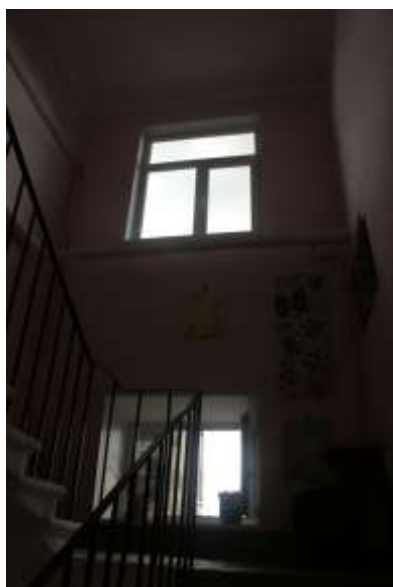
Фото 70. Выявленный объект культурного наследия «Дом Ш. З. Иофа», расположенный по адресу Санкт-Петербург, ул. Белинского, д. 13, Литейный пр., д. 47. Вид лестницы № 4 (со стороны двора). Съемка 26.04.2021. Егорова Т. Г.
