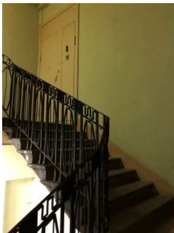
Фото 11. Выявленный объект культурного наследия «Дом Ш. З. Иофа», расположенный по адресу Санкт-Петербург, ул. Белинского, д. 13, Литейный пр., д. 47. Вид парадной лестницы. Съемка 26.04.2021. Егорова Т. Г.
