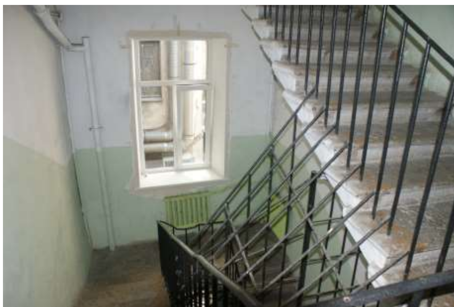
Фото 85. Выявленный объект культурного наследия «Дом Ш. З. Иофа», расположенный по адресу Санкт-Петербург, ул. Белинского, д. 13, Литейный пр., д. 47. Вид лестницы № 3 (со стороны двора). Съемка 26.04.2021. Егорова Т. Г.
