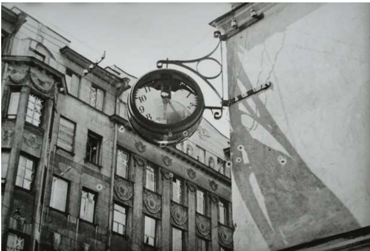
Илл. 37. Вид на часть северного фасада дома Ш. З. Иофа со стороны Литейного пр., 1941–1944 гг. Источник: www.pastvu.com
