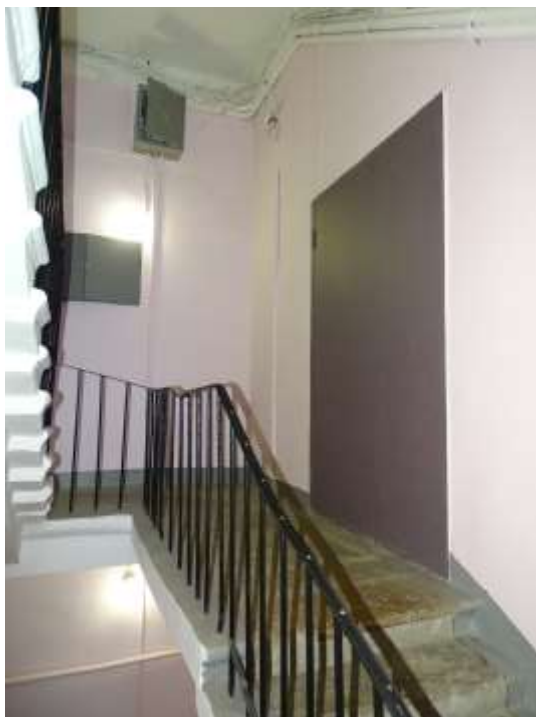
Фото 63. Выявленный объект культурного наследия «Дом Ш. З. Иофа», расположенный по адресу Санкт-Петербург, ул. Белинского, д. 13, Литейный пр., д. 47. Вид лестницы № 4 (со стороны двора). Съемка 26.04.2021. Егорова Т. Г.
