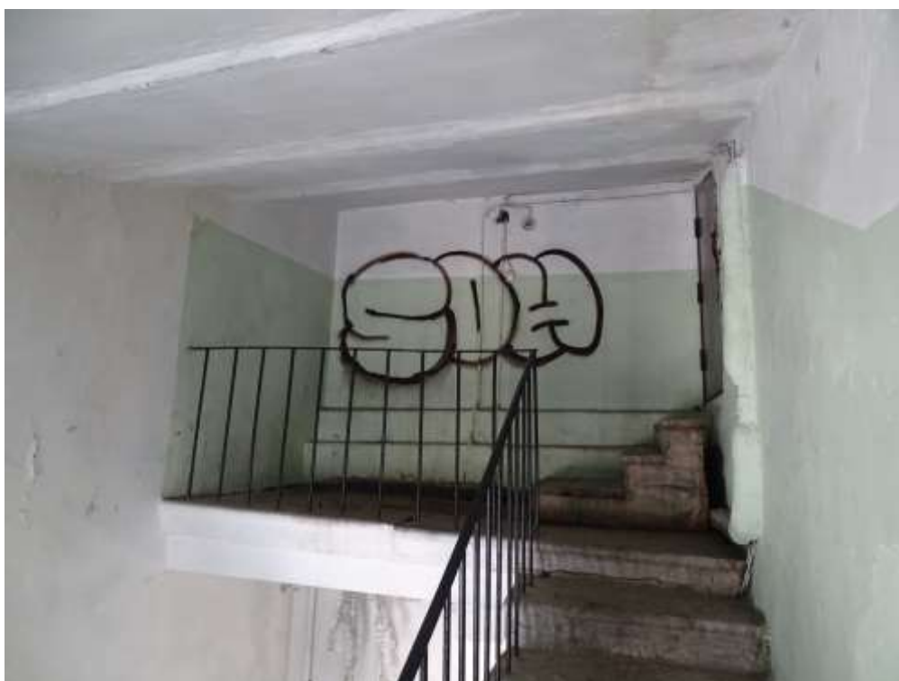
Фото 89. Выявленный объект культурного наследия «Дом Ш. З. Иофа», расположенный по адресу Санкт-Петербург, ул. Белинского, д. 13, Литейный пр., д. 47. Вид лестницы № 3 (со стороны двора). Съемка 26.04.2021. Егорова Т. Г.
