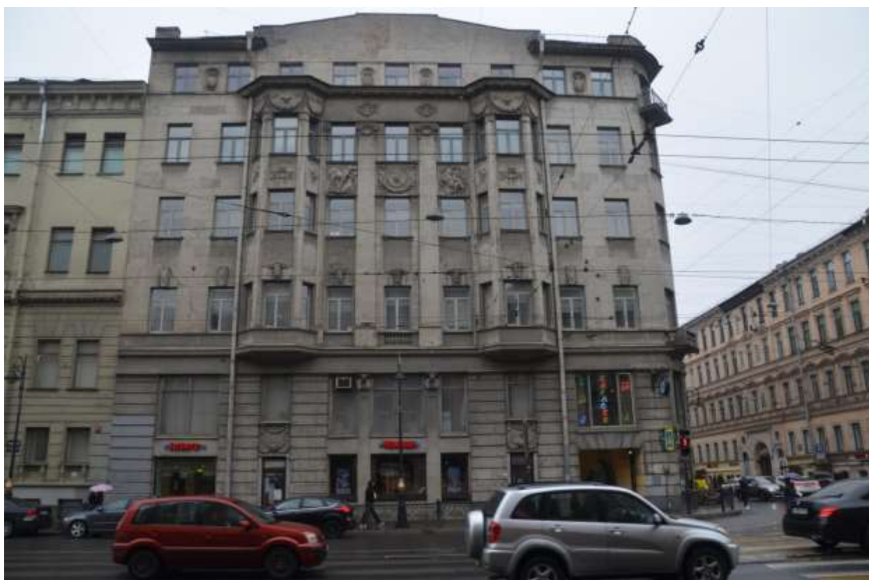
Фото 06. Выявленный объект культурного наследия «Дом Ш. З. Иофа», расположенный по адресу Санкт-Петербург, ул. Белинского, д. 13, Литейный пр., д. 47. Вид восточного фасада. Фрагмент. Съемка 26.04.2021. Егорова Т. Г.
