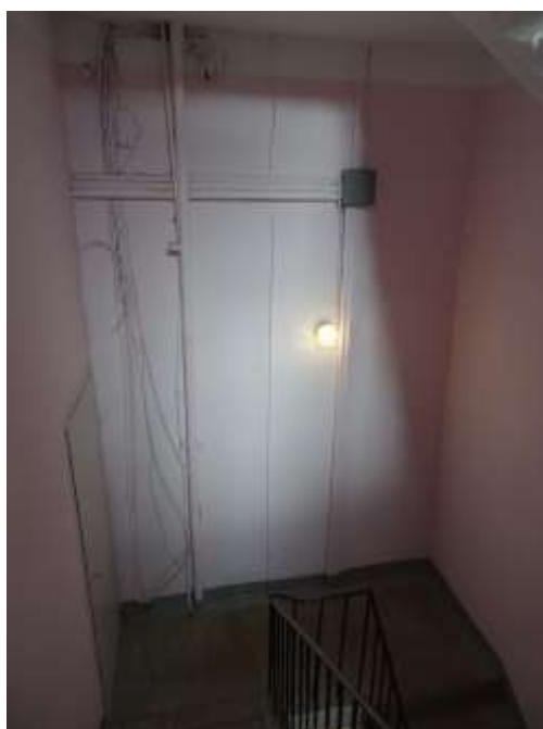
Фото 66. Выявленный объект культурного наследия «Дом Ш. З. Иофа», расположенный по адресу Санкт-Петербург, ул. Белинского, д. 13, Литейный пр., д. 47. Вид лестницы № 4 (со стороны двора). Съемка 26.04.2021. Егорова Т. Г.
