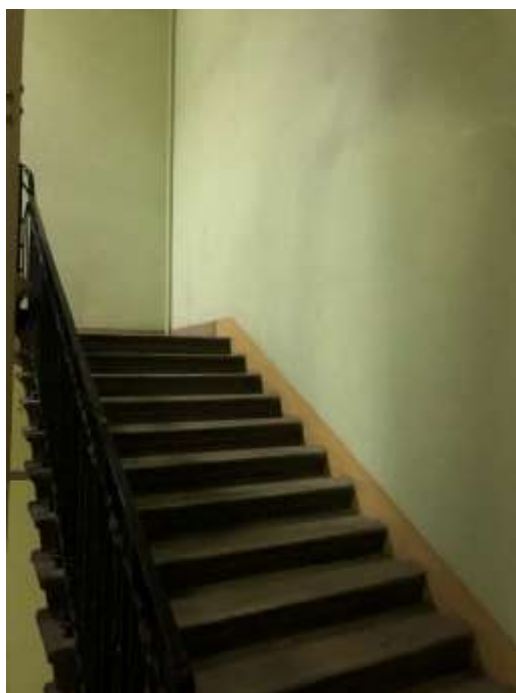
Фото 12. Выявленный объект культурного наследия «Дом Ш. З. Иофа», расположенный по адресу Санкт-Петербург, ул. Белинского, д. 13, Литейный пр., д. 47. Вид парадной лестницы. Съемка 26.04.2021. Егорова Т. Г.
