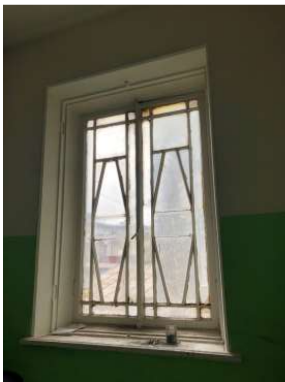
Фото 25. Выявленный объект культурного наследия «Дом Ш. З. Иофа», расположенный по адресу Санкт-Петербург, ул. Белинского, д. 13, Литейный пр., д. 47. Историческое оконное заполнение окон черной лестницы. Съемка 26.04.2021. Егорова Т. Г.
