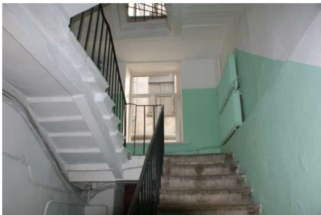
Фото 76. Выявленный объект культурного наследия «Дом Ш. З. Иофа», расположенный по адресу Санкт-Петербург, ул. Белинского, д. 13, Литейный пр., д. 47. Вид лестницы № 3 (со стороны двора). Съемка 26.04.2021. Егорова Т. Г.
