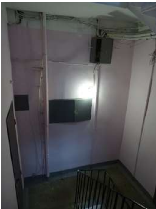
Фото 64. Выявленный объект культурного наследия «Дом Ш. З. Иофа», расположенный по адресу Санкт-Петербург, ул. Белинского, д. 13, Литейный пр., д. 47. Вид лестницы № 4 (со стороны двора). Съемка 26.04.2021. Егорова Т. Г.
