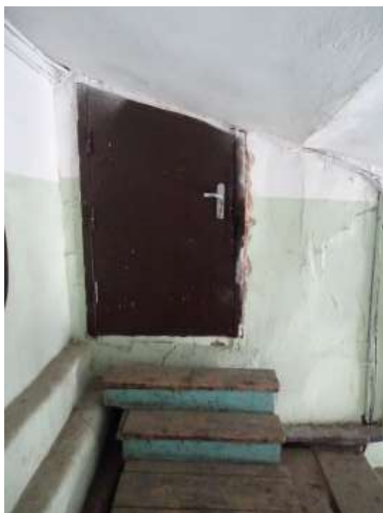
Фото 90. Выявленный объект культурного наследия «Дом Ш. З. Иофа», расположенный по адресу Санкт-Петербург, ул. Белинского, д. 13, Литейный пр., д. 47. Вид лестницы № 3 (со стороны двора). Съемка 26.04.2021. Егорова Т. Г.
