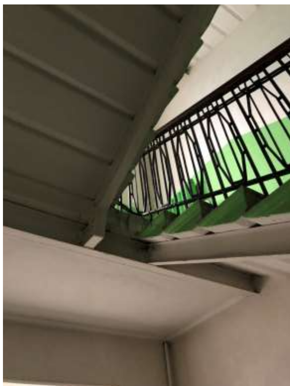
Фото 30. Выявленный объект культурного наследия «Дом Ш. З. Иофа», расположенный по адресу Санкт-Петербург, ул. Белинского, д. 13, Литейный пр., д. 47. Вид конструкции черной лестницы. Съемка 26.04.2021. Егорова Т. Г.
