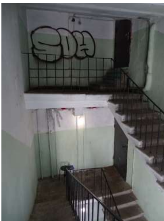
Фото 88. Выявленный объект культурного наследия «Дом Ш. З. Иофа», расположенный по адресу Санкт-Петербург, ул. Белинского, д. 13, Литейный пр., д. 47. Вид лестницы № 3 (со стороны двора). Съемка 26.04.2021. Егорова Т. Г.
