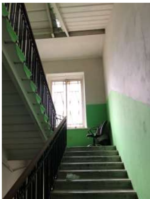
Фото 22 Выявленный объект культурного наследия «Дом Ш. З. Иофа», расположенный по адресу Санкт-Петербург, ул. Белинского, д. 13, Литейный пр., д. 47. Вид черной лестницы. Съемка 26.04.2021. Егорова Т. Г.
