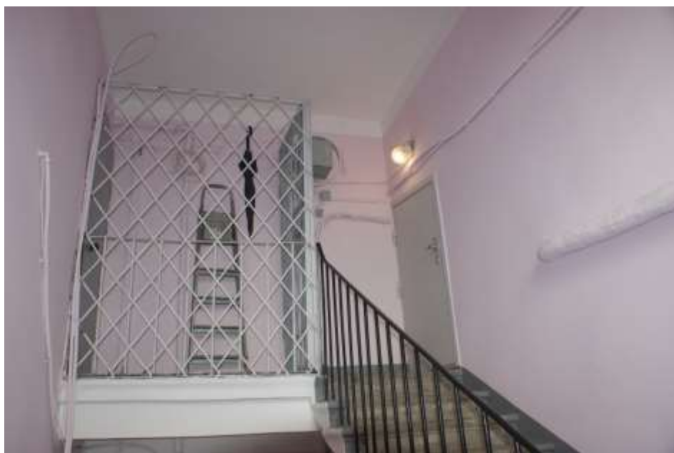
Фото 71. Выявленный объект культурного наследия «Дом Ш. З. Иофа», расположенный по адресу Санкт-Петербург, ул. Белинского, д. 13, Литейный пр., д. 47. Вид лестницы № 4 (со стороны двора). Съемка 26.04.2021. Егорова Т. Г.
