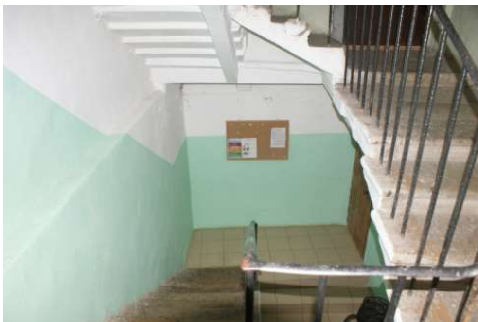
Фото 78. Выявленный объект культурного наследия «Дом Ш. З. Иофа», расположенный по адресу Санкт-Петербург, ул. Белинского, д. 13, Литейный пр., д. 47. Вид лестницы № 3 (со стороны двора). Съемка 26.04.2021. Егорова Т. Г.
