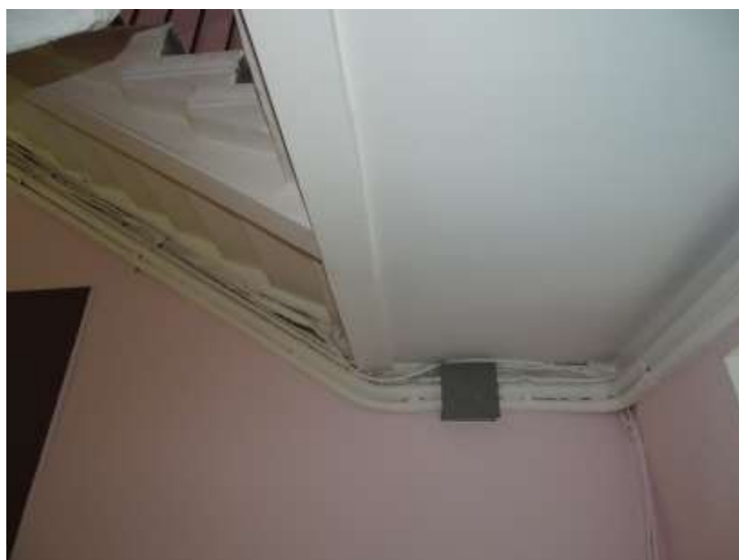
Фото 72. Выявленный объект культурного наследия «Дом Ш. З. Иофа», расположенный по адресу Санкт-Петербург, ул. Белинского, д. 13, Литейный пр., д. 47. Вид конструкции лестницы № 4 (со стороны двора). Съемка 26.04.2021. Егорова Т. Г.
