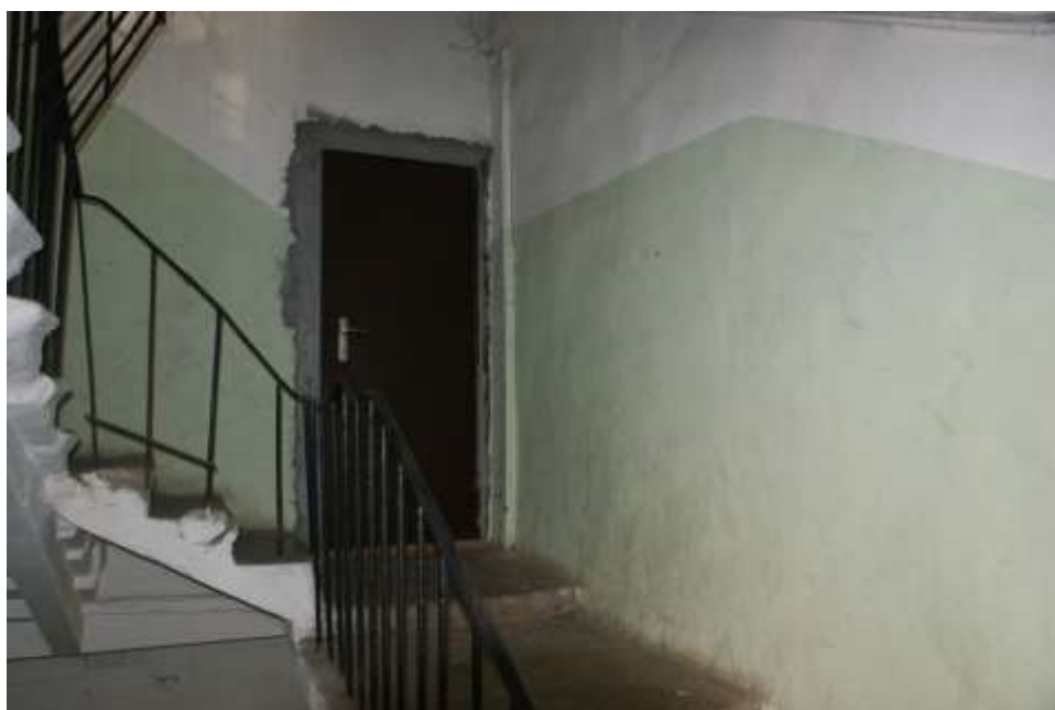
Фото 79. Выявленный объект культурного наследия «Дом Ш. З. Иофа», расположенный по адресу Санкт-Петербург, ул. Белинского, д. 13, Литейный пр., д. 47. Вид лестницы № 3 (со стороны двора). Съемка 26.04.2021. Егорова Т. Г.
