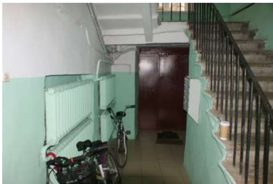
Фото 74. Выявленный объект культурного наследия «Дом Ш. З. Иофа», расположенный по адресу Санкт-Петербург, ул. Белинского, д. 13, Литейный пр., д. 47. Вид лестницы № 3 (со стороны двора). Съемка 26.04.2021. Егорова Т. Г.
