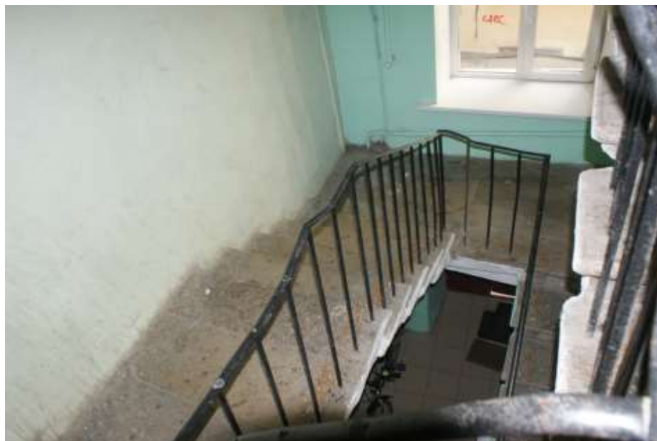
Фото 81. Выявленный объект культурного наследия «Дом Ш. З. Иофа», расположенный по адресу Санкт-Петербург, ул. Белинского, д. 13, Литейный пр., д. 47. Вид лестницы № 3 (со стороны двора). Съемка 26.04.2021. Егорова Т. Г.
