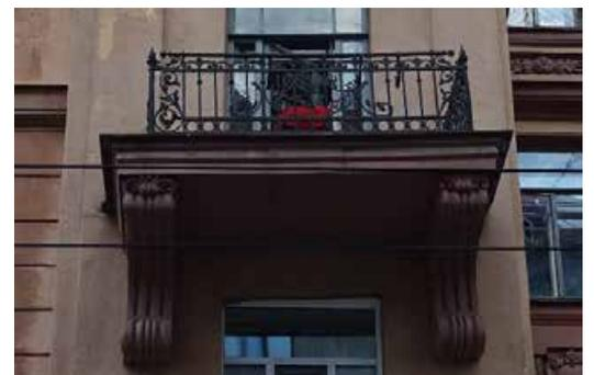
трапециевидный в плане эркер (в уровне третьего-пятого этажей), расположенный по центральной оси; балкон на эркере;
