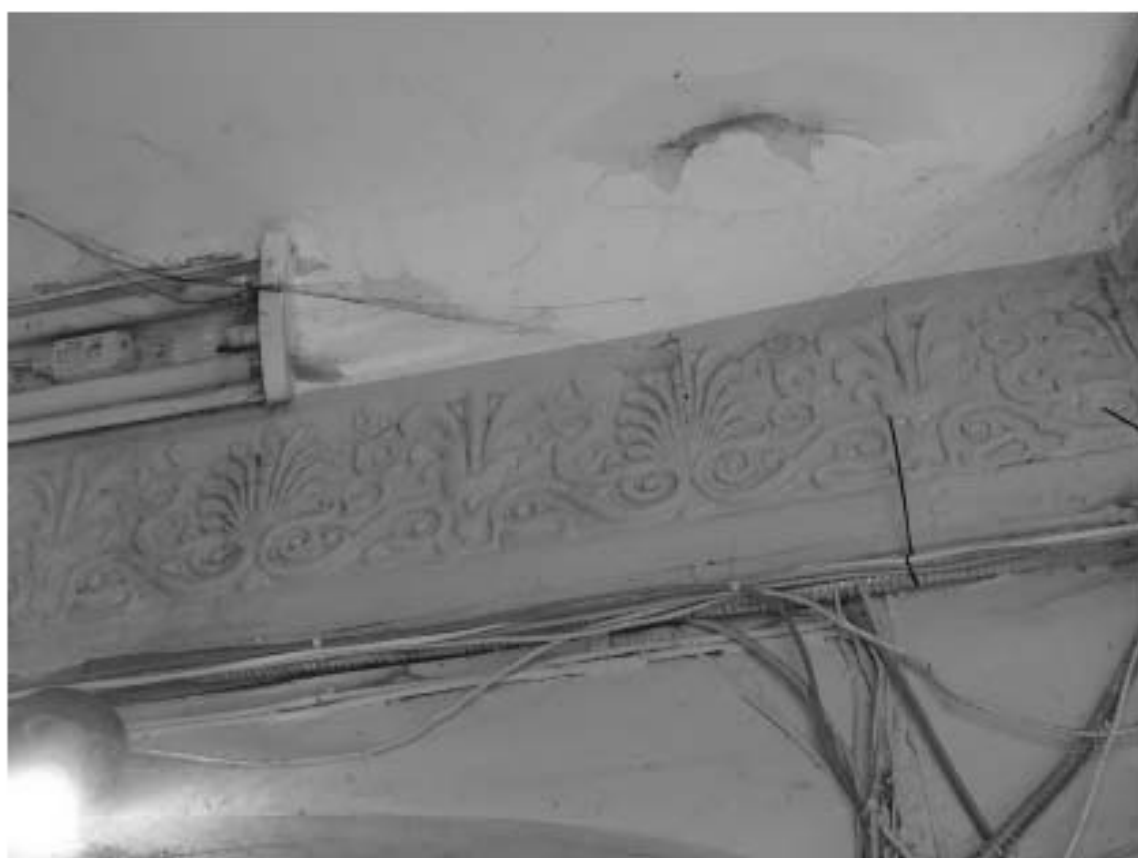
Фото 48. Лестница № 3: Вестибюль 1-го этажа. Съемка 26.04.2021 г. Михайловская Г. В.
