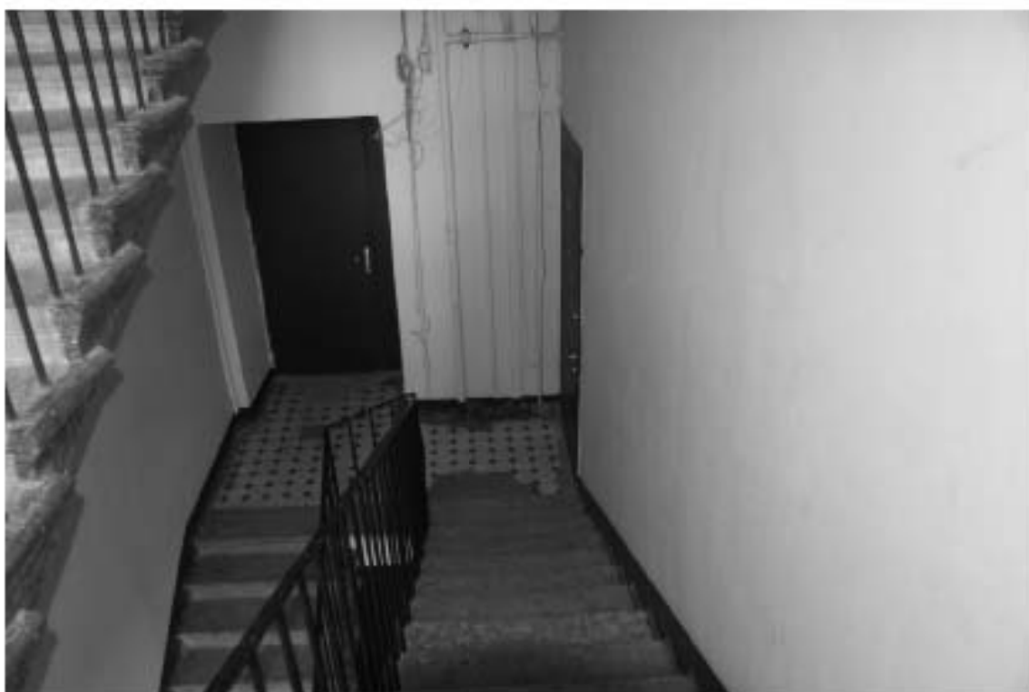
Фото 9. Лестница № 1: 3 этаж. Съемка 26.04.2021 г. Михайловская Г. В.
