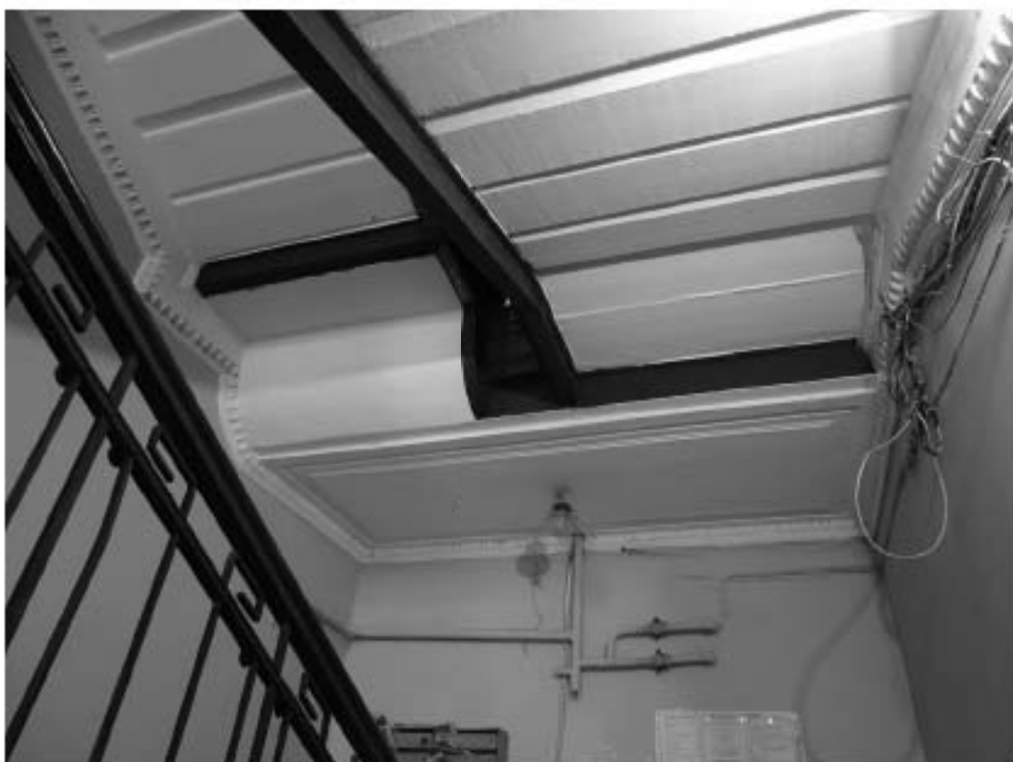
Фото 49. Лестница № 3: Вестибюль 1-го этажа. Съемка 26.04.2021 г. Михайловская Г. В.
