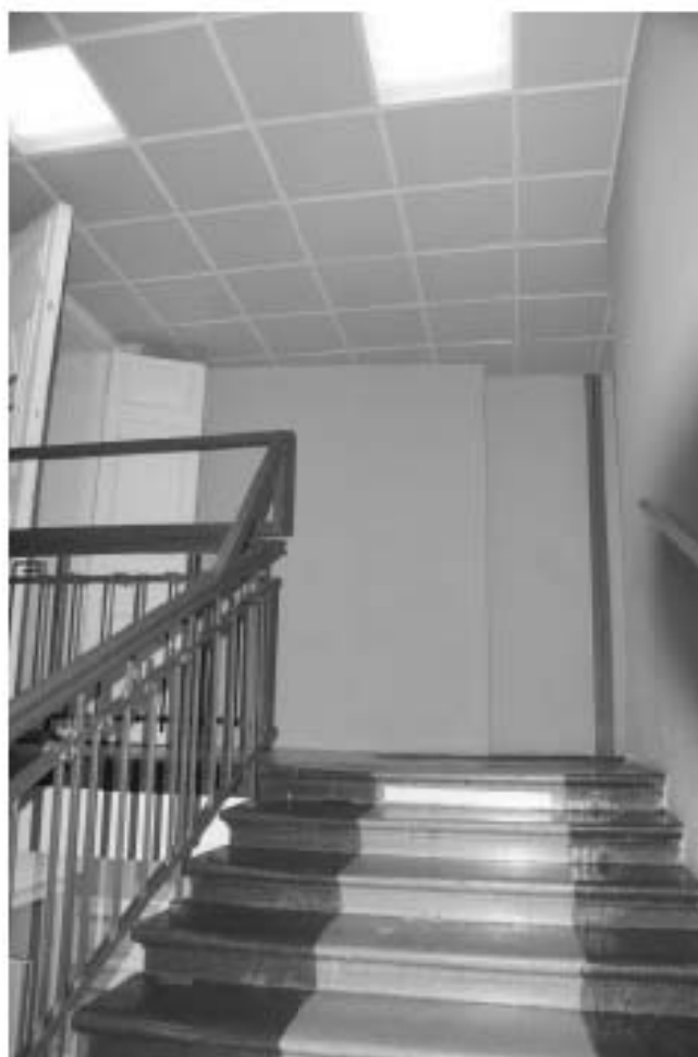
Фото 40. Лестница № 2: Площадка 6-го этажа. Съемка 26.04.2021 г. Михайловская Г. В.
