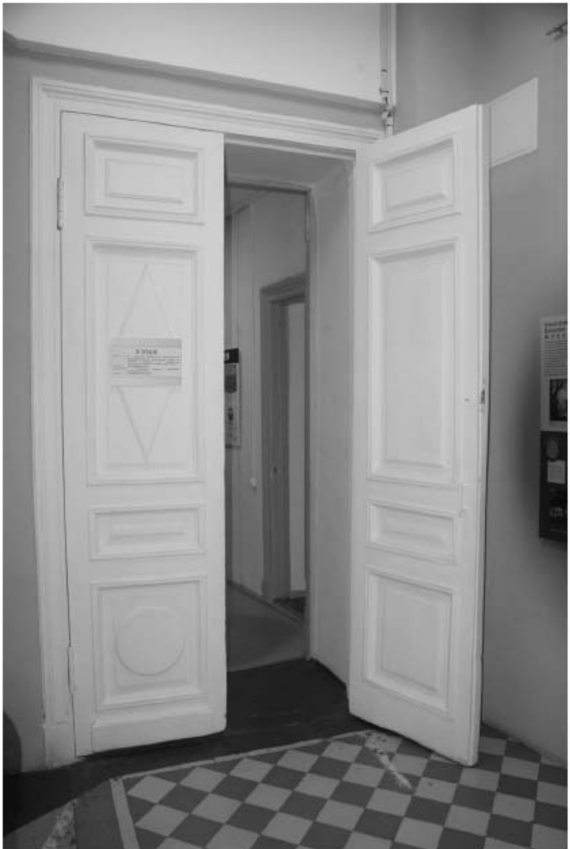
Фото 28. Лестница № 2: Площадка 3-го этажа. Оформление двери. Съемка 26.04.2021 г. Михайловская Г. В.
