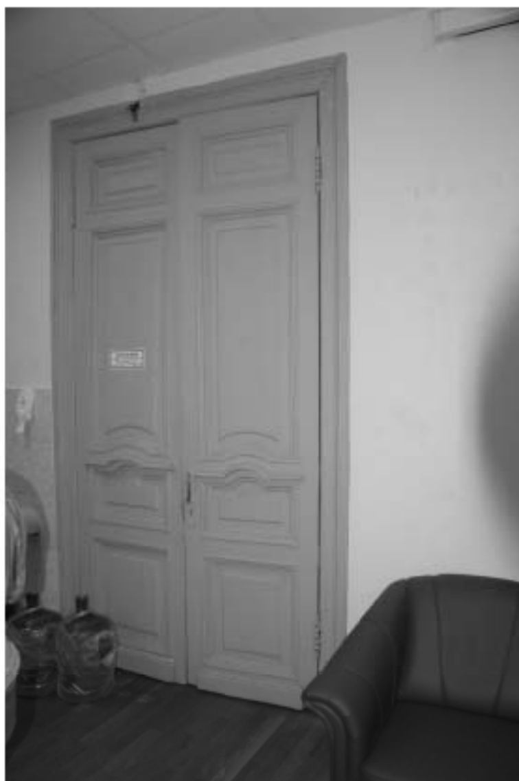
Фото 14. 3-й этаж. Помещение 12/53,6. Оформление двери. Съемка 26.04.2021 г. Михайловская Г. В.
