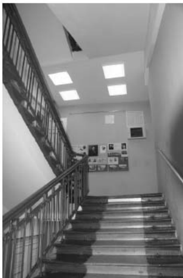
Фото 26. Лестница № 2: Площадка 3-го этажа. Съемка 26.04.2021 г. Михайловская Г. В.
