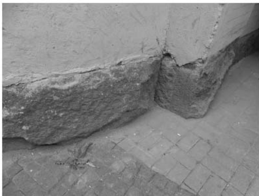
Фото 43. Замкнутый двор. Фрагмент фасада. Цоколь из красного гранита. Съемка 26.04.2021 г. Михайловская Г. В.
