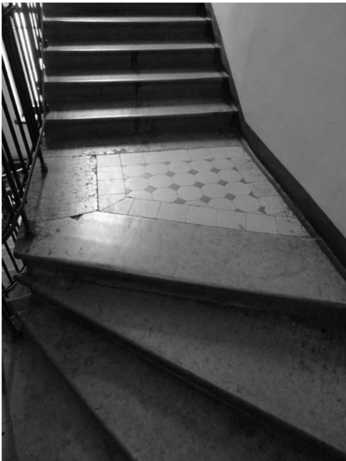
Фото 62. Лестница № 3: 3 этаж. Съёмка 26.04.2021 г. Михайловская Г. В.
