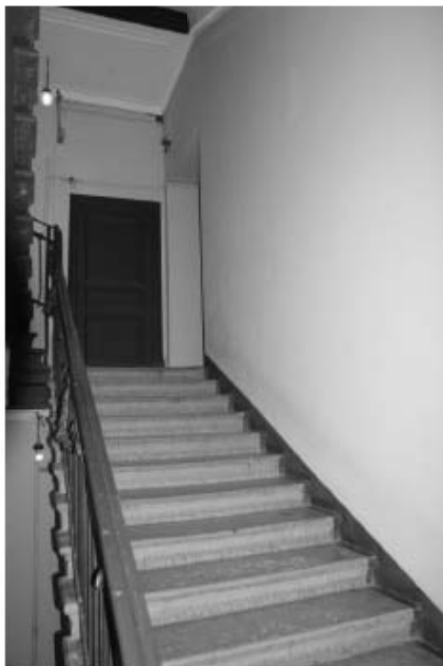
Фото 65. Лестница № 3: 4-й этаж. Съемка 26.04.2021 г. Михайловская Г. В.
