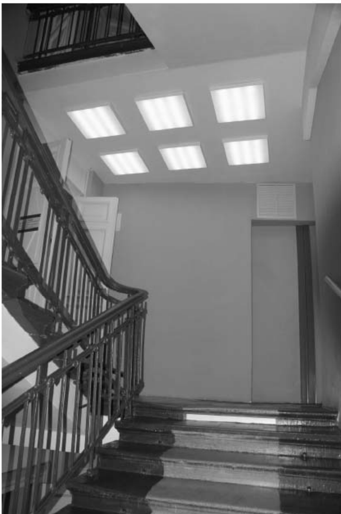
Фото 36. Лестница № 2: Площадка 5-го этажа. Съемка 26.04.2021 г. Михайловская Г. В.
