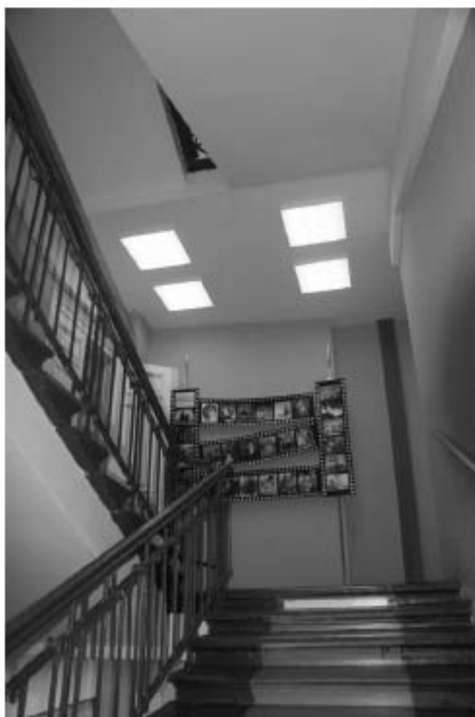
Фото 32. Лестница № 2: Площадка 4-го этажа. Съемка 26.04.2021 г. Михайловская Г. В.
