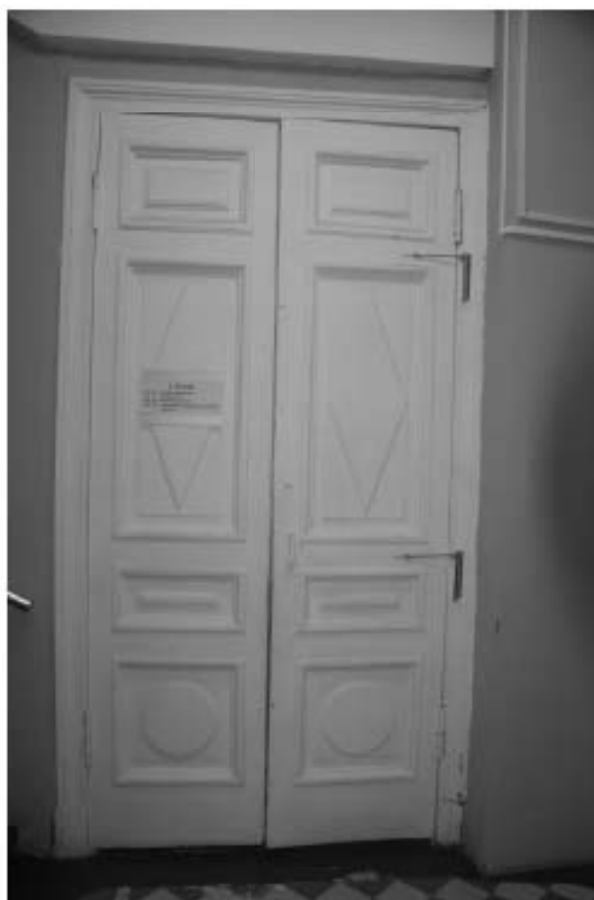
Фото 23. Лестница № 2: Площадка 2-го этажа. Съемка 26.04.2021 г. Михайловская Г. В.
