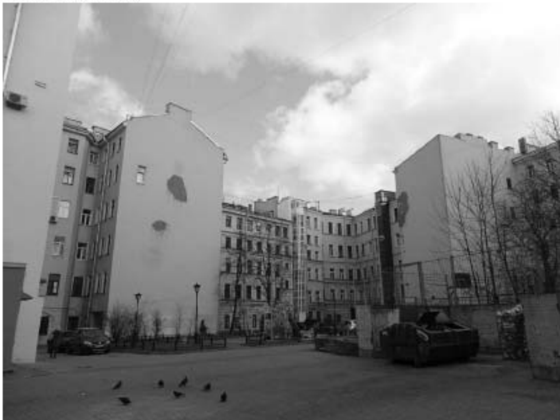
Фото 17. Дворовые фасады. Съемка 26.04.2021 г. Михайловская Г. В.
