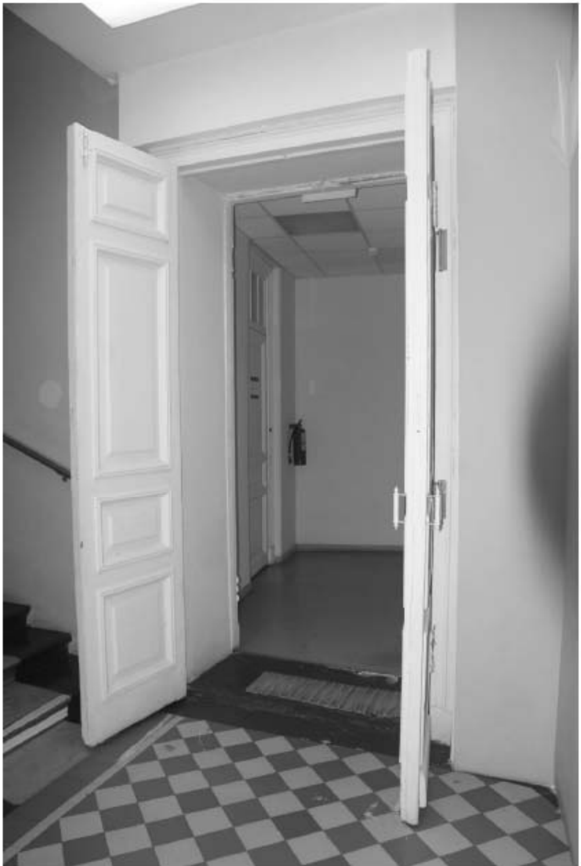
Фото 38. Лестница № 2: Площадка 5-го этажа. Оформление двери. Съемка 26.04.2021 г. Михайловская Г. В.
