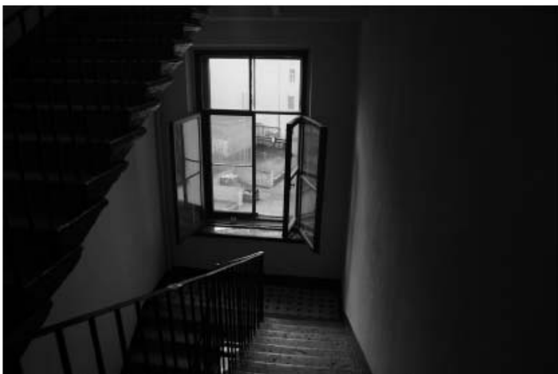
Фото 8. Лестница № 1: Площадка между 2-м и 3-м этажом. Съемка 26.04.2021 г. Михайловская Г. В.
