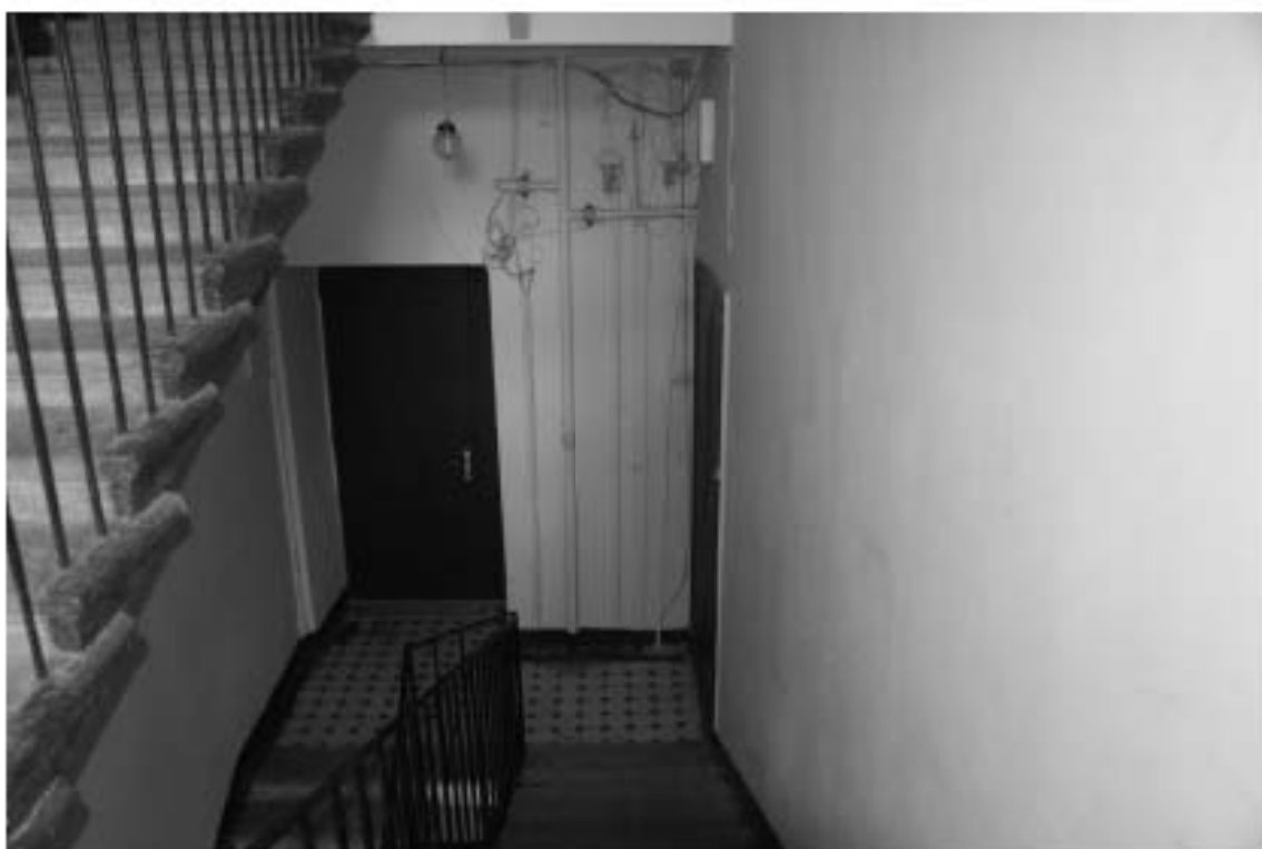
Фото 7. Лестница № 1: 2 этаж. Съемка 26.04.2021 г. Михайловская Г. В.
