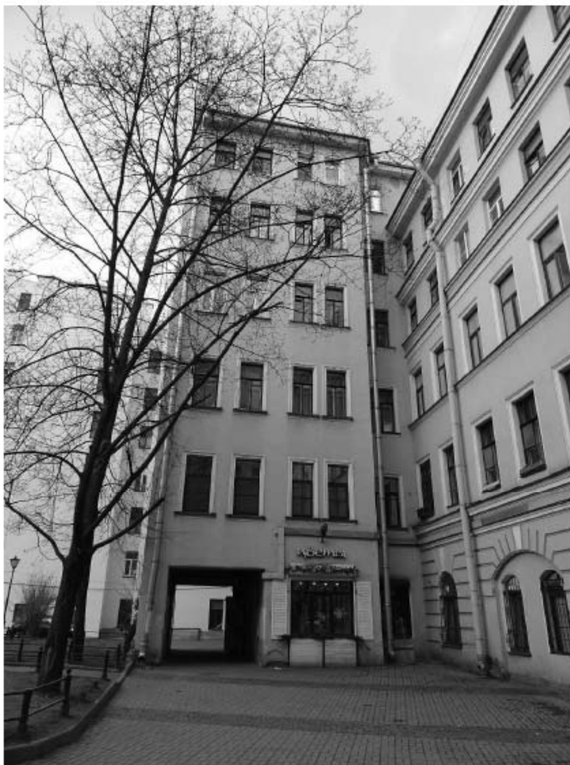
Фото 19. Дворовые фасады. Съемка 26.04.2021 г. Михайловская Г. В.
