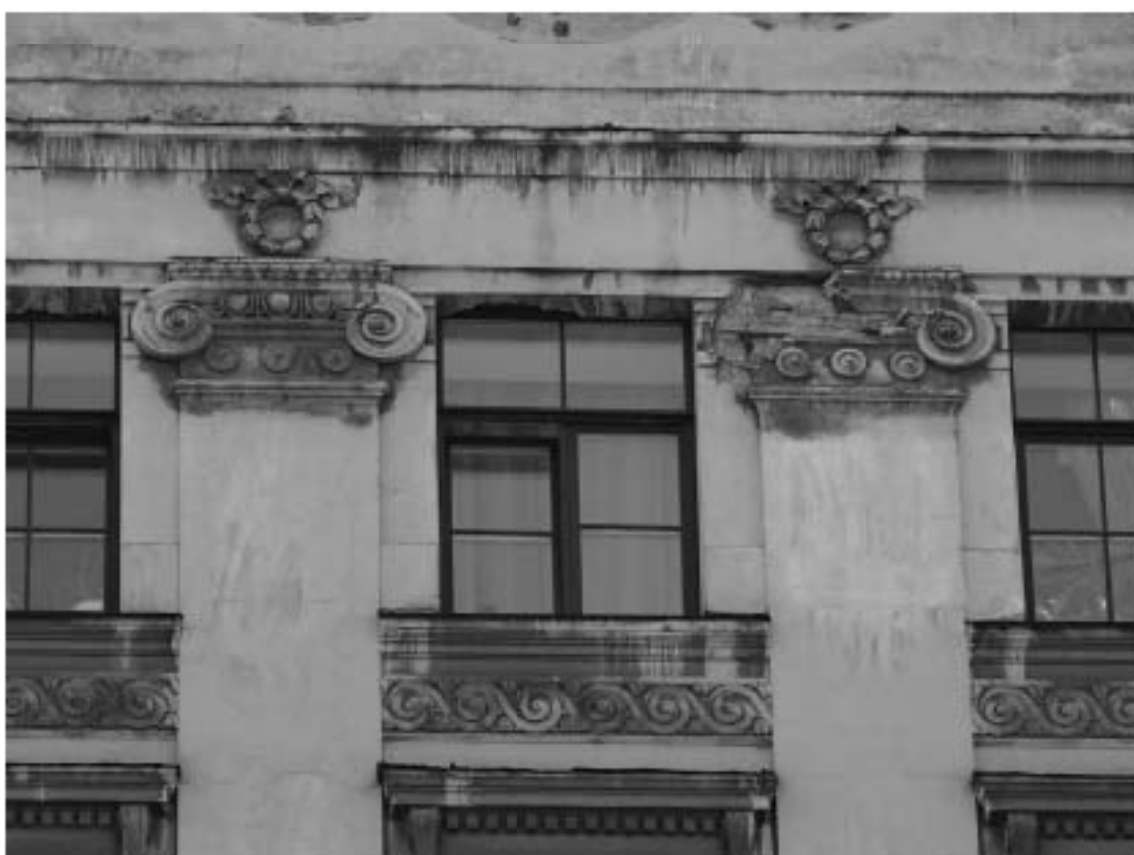
Фото 4. Декоративные элементы лицевого фасада. Фрагмент. Съемка 26.04.2021 г. Михайловская Г. В.
