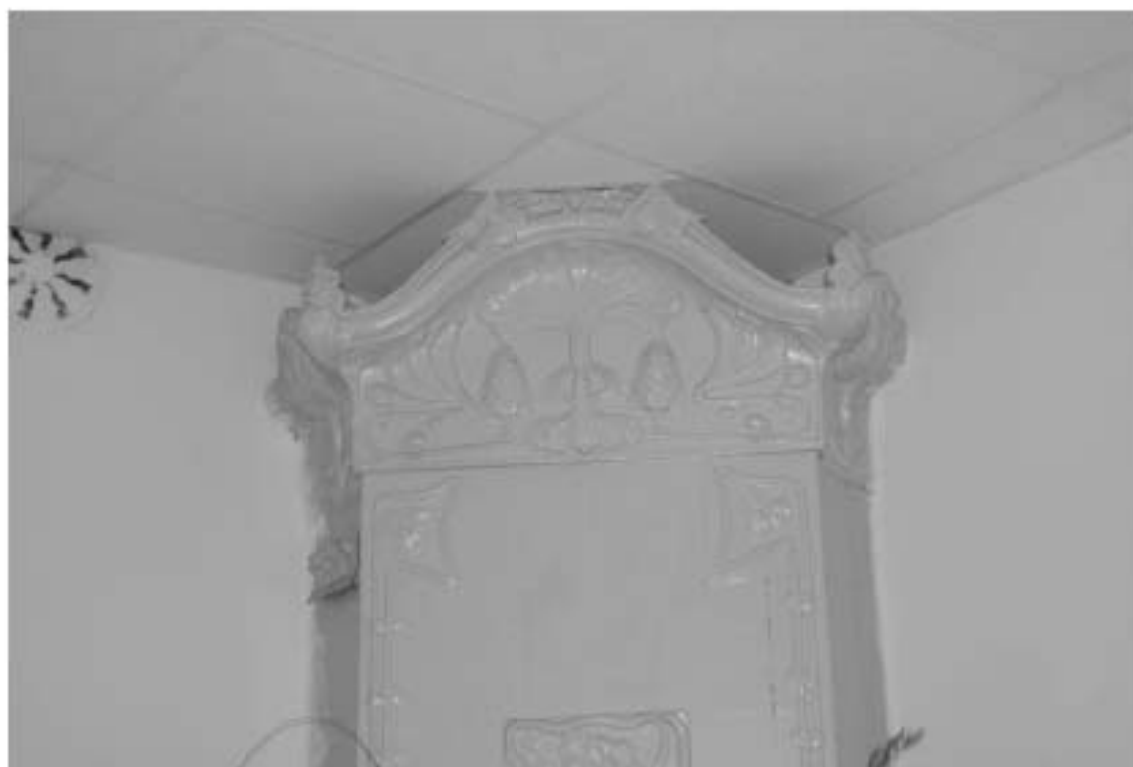
Фото 11. 3-й этаж. Помещение 12/53,6. Печь угловая. Завершение печи. Съемка 26.04.2021 г. Михайловская Г. В.
