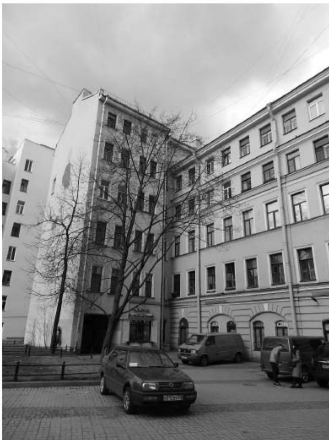
Фото 18. Дворовые фасады. Съемка 26.04.2021 г. Михайловская Г. В.
