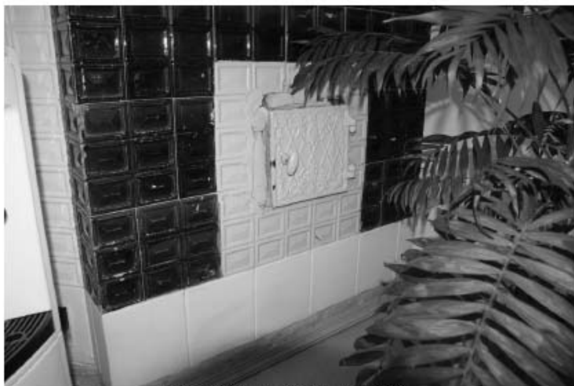
Фото 18. 4-й этаж. Помещение 3/50,5. Печь угловая. Дверца топки. Съемка 26.04.2021 г. Михайловская Г. В.
