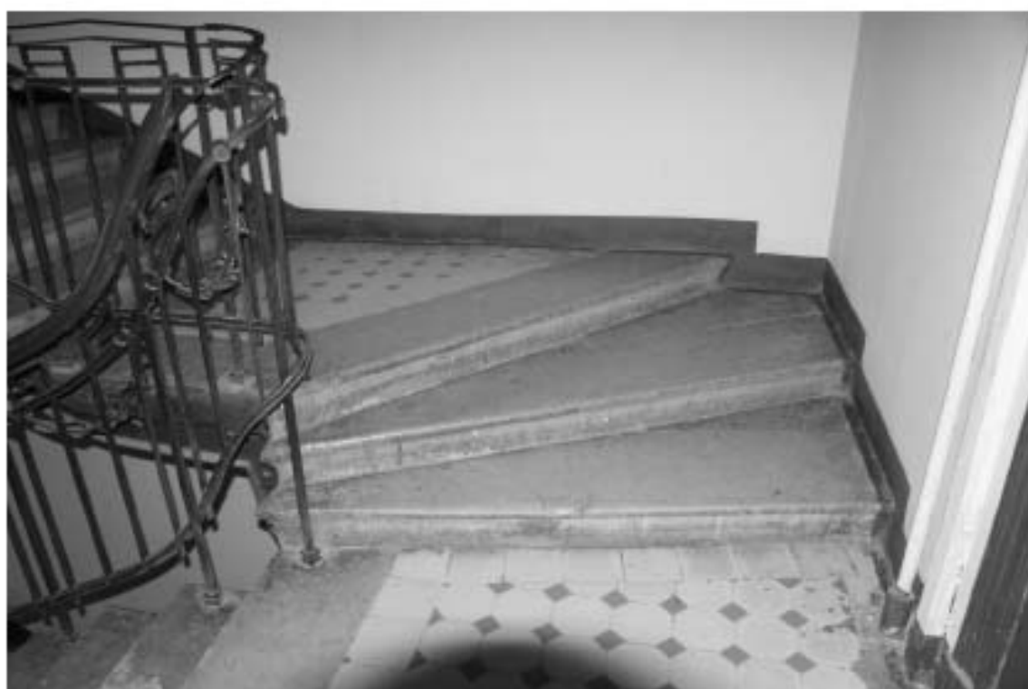
Фото 66. Лестница № 3: 4-й этаж. Съемка 26.04.2021 г. Михайловская Г. В.
