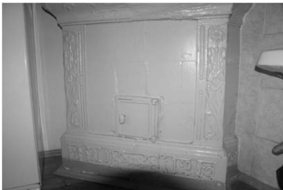
Фото 13. 3-й этаж. Помещение 12/53,6. Печь угловая. Дверца топки. Съемка 26.04.2021 г. Михайловская Г. В.
