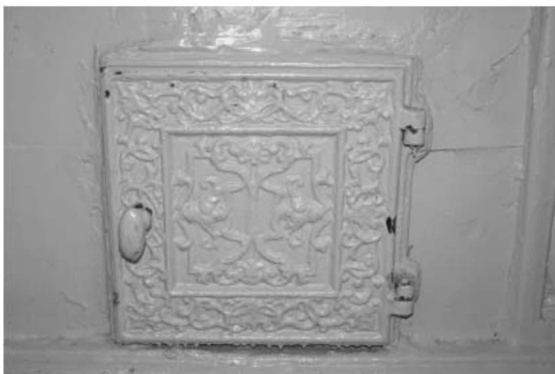
Фото 7. 3-й этаж. Помещение 11/28,1. Печь угловая. Дверца топки. Съемка 26.04.2021 г. Михайловская Г. В.
