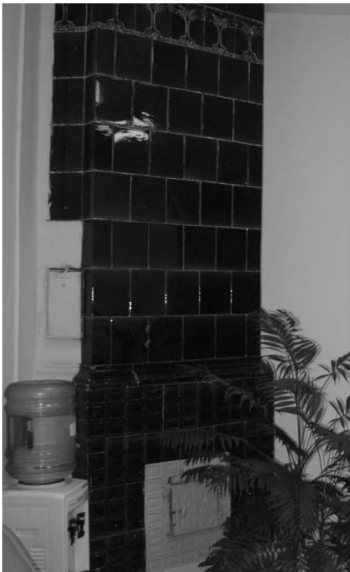
Фото 16. 4-й этаж. Помещение 3/50,5. Печь угловая. Съемка 26.04.2021 г. Михайловская Г. В.
