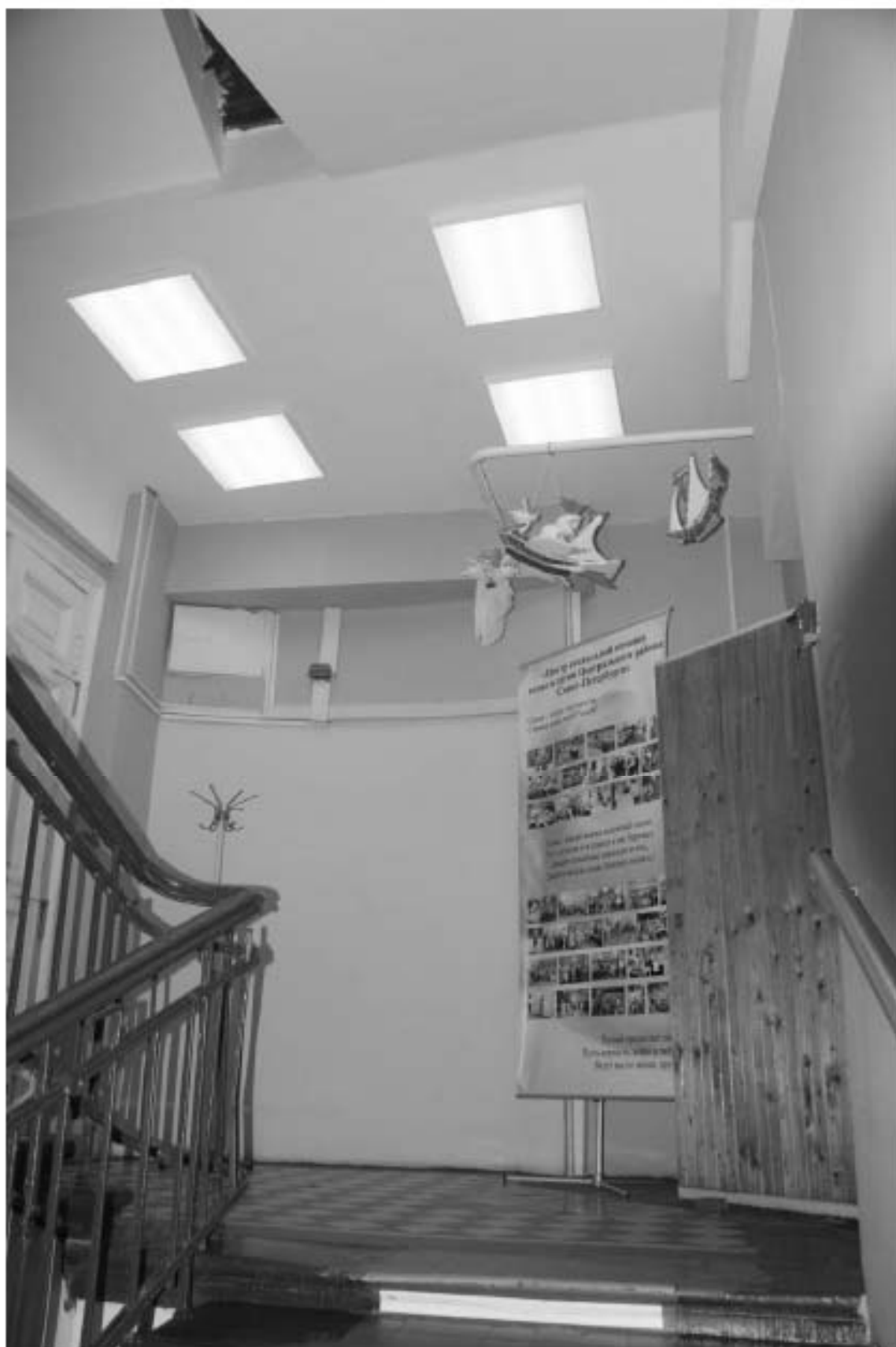
Фото 21. Лестница № 2: Площадка 2-го этажа. Съемка 26.04.2021 г. Михайловская Г. В.
