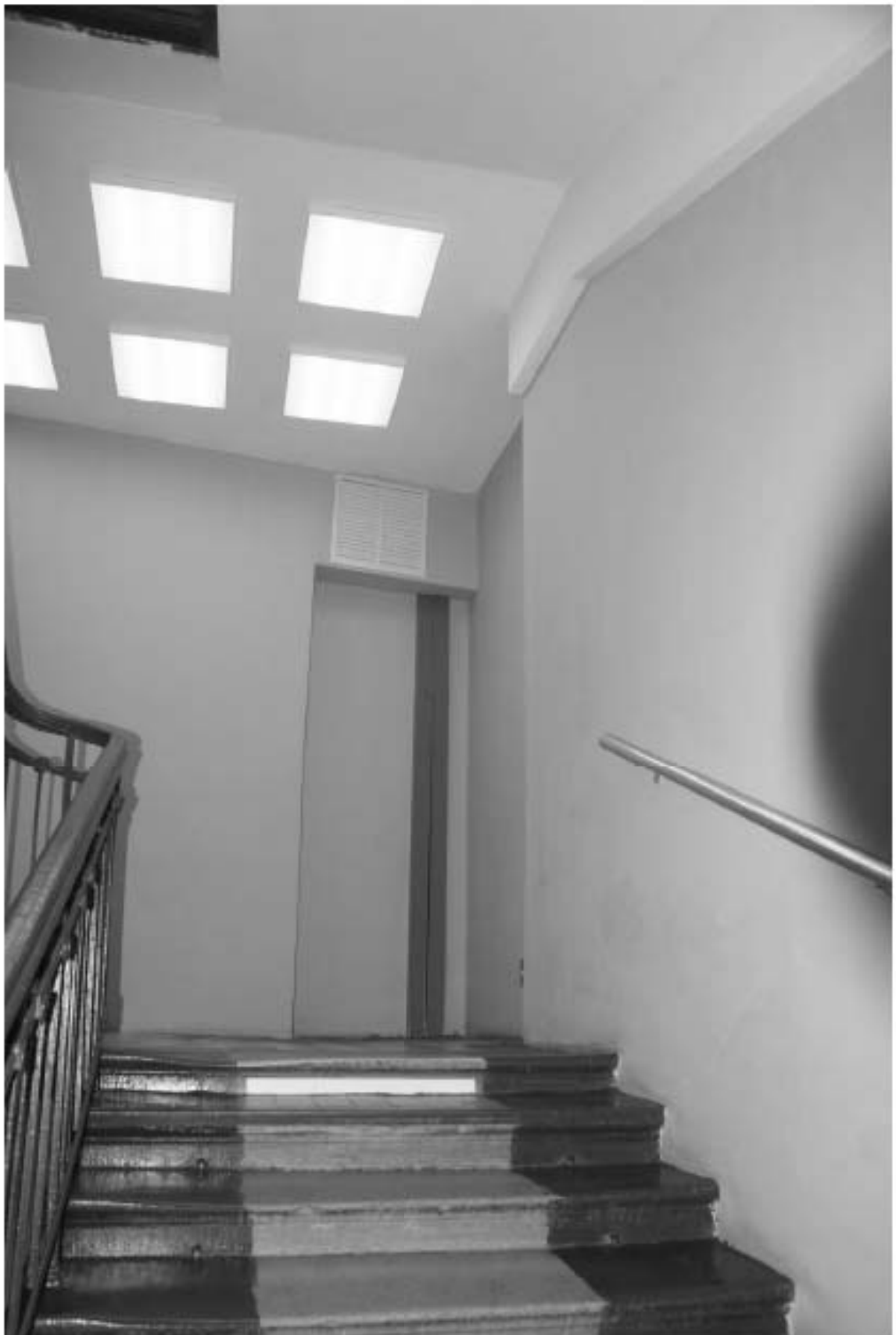
Фото 37. Лестница № 2: Площадка 5-го этажа. Съемка 26.04.2021 г. Михайловская Г. В.
