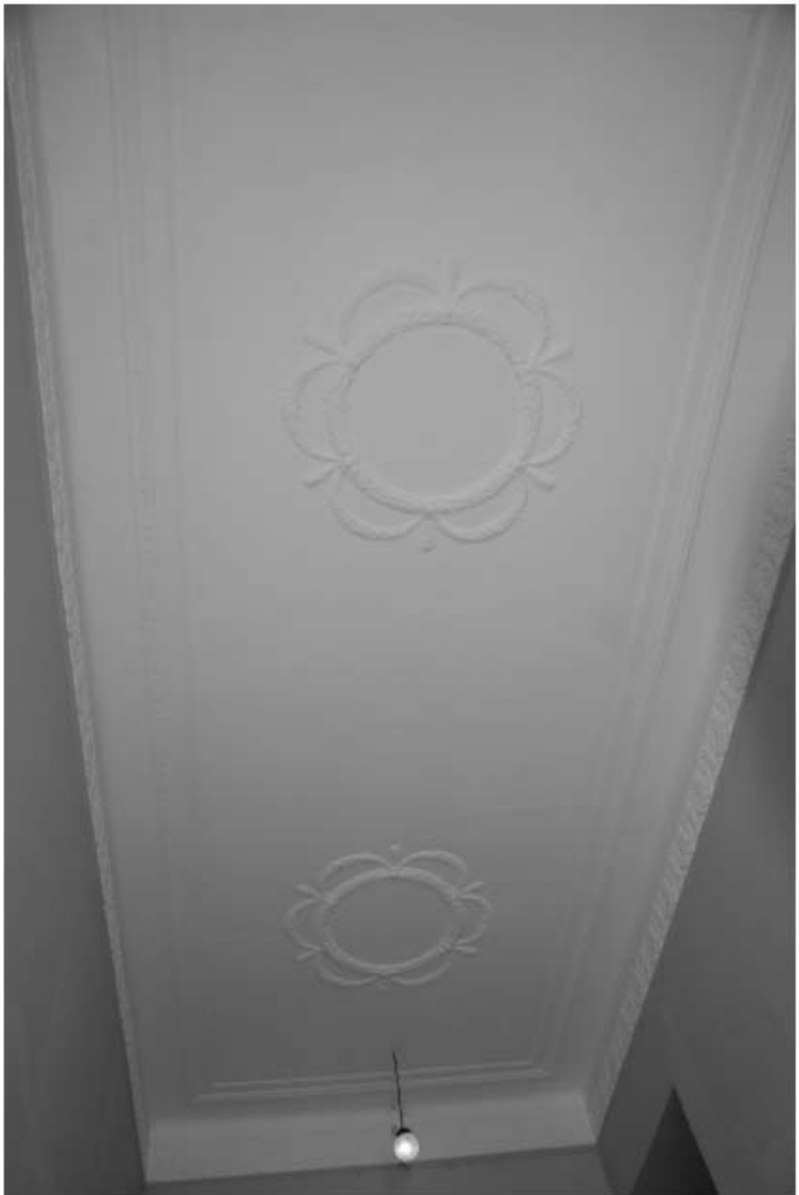
Фото 73. Лестница № 3: 6 этаж. Декорирование потолка. Съемка 26.04.2021 г. Михайловская Г. В.
