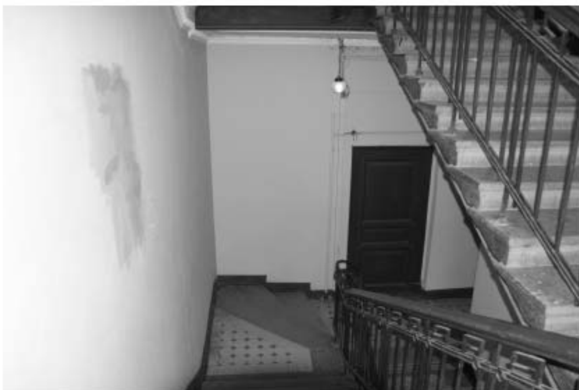
Фото 67. Лестница № 3: 4-й этаж. Съёмка 26.04.2021 г. Михайловская Г. В.
