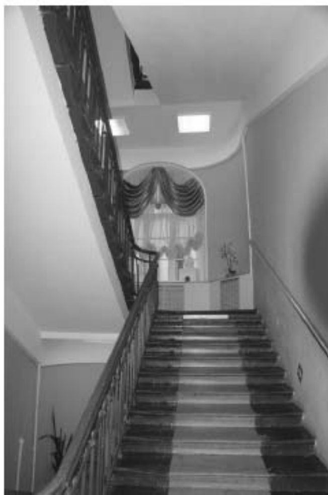
Фото 24. Площадка между 2-м и 3-м этажом. Съемка 26.04.2021 г. Михайловская Г. В.
