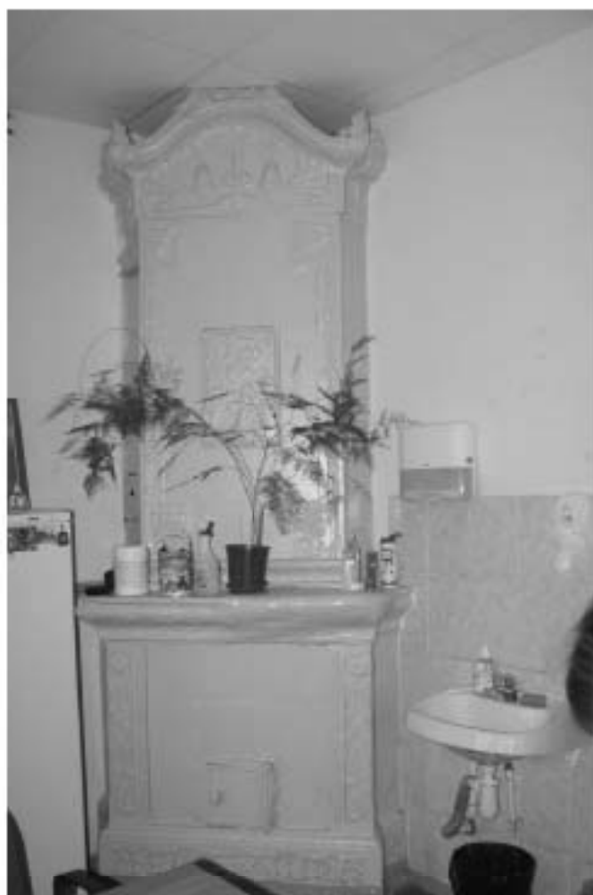
Фото 10. 3-й этаж. Помещение 12/53,6. Печь угловая. Съемка 26.04.2021 г. Михайловская Г. В.
