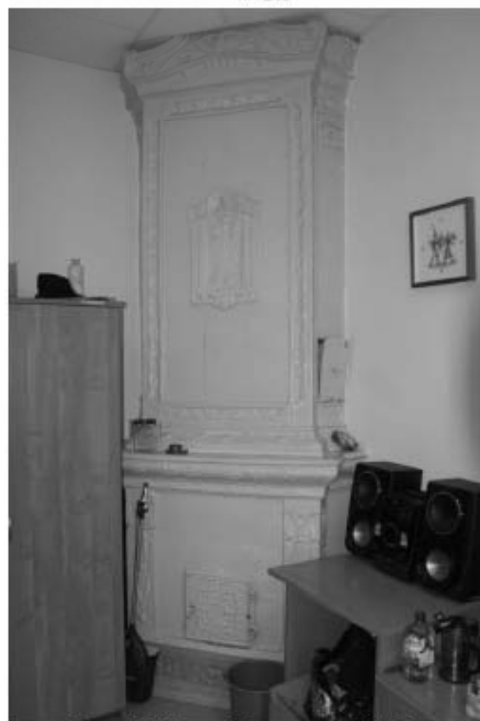
Фото 4. 3-й этаж. Помещение 11/28.1. Печь угловая. Съемка 26.04.2021 г. Михайловская Г. В.
