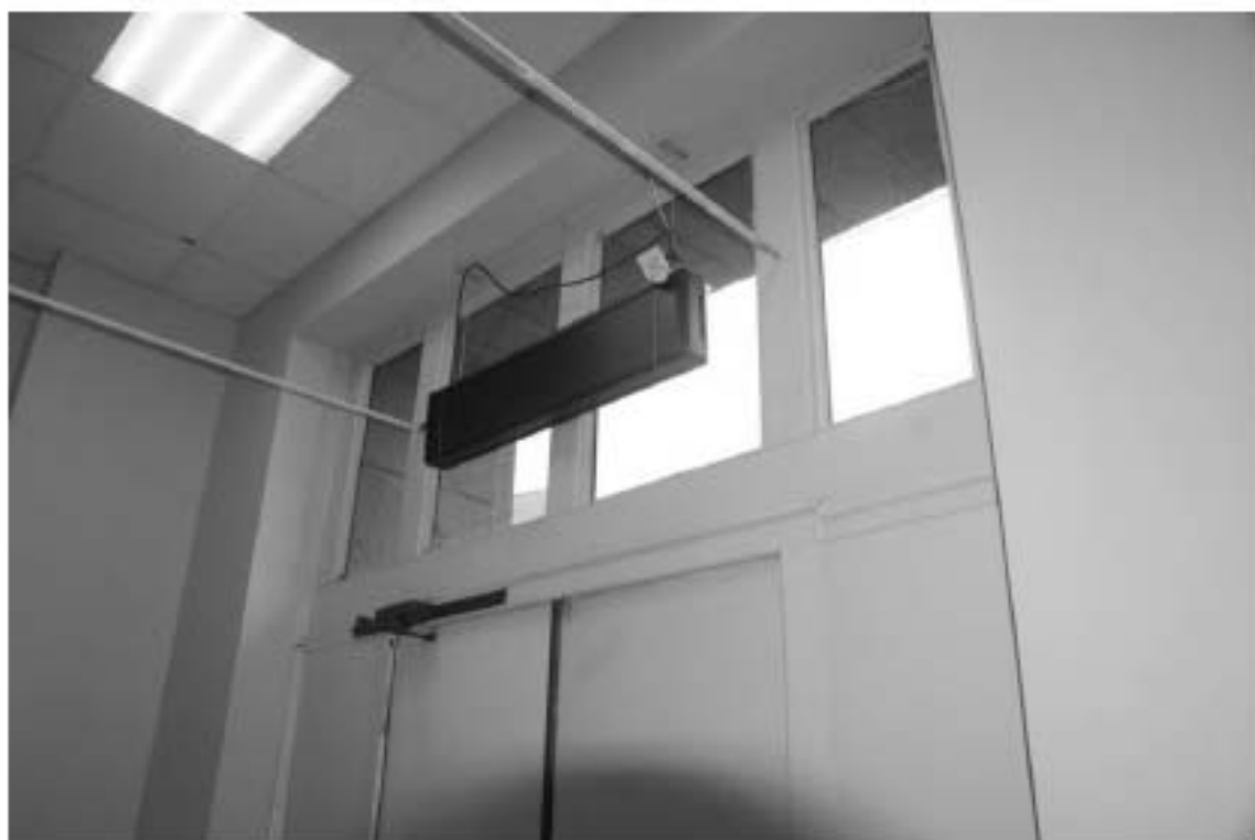
Фото 16. Лестница № 2: Тамбур.1-го этажа. Съемка 26.04.2021 г. Михайловская Г. В.
