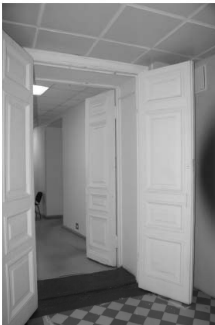
Фото 42. Лестница № 2: Площадка 6-го этажа. Оформление двери. Съемка 26.04.2021 г. Михайловская Г. В.
