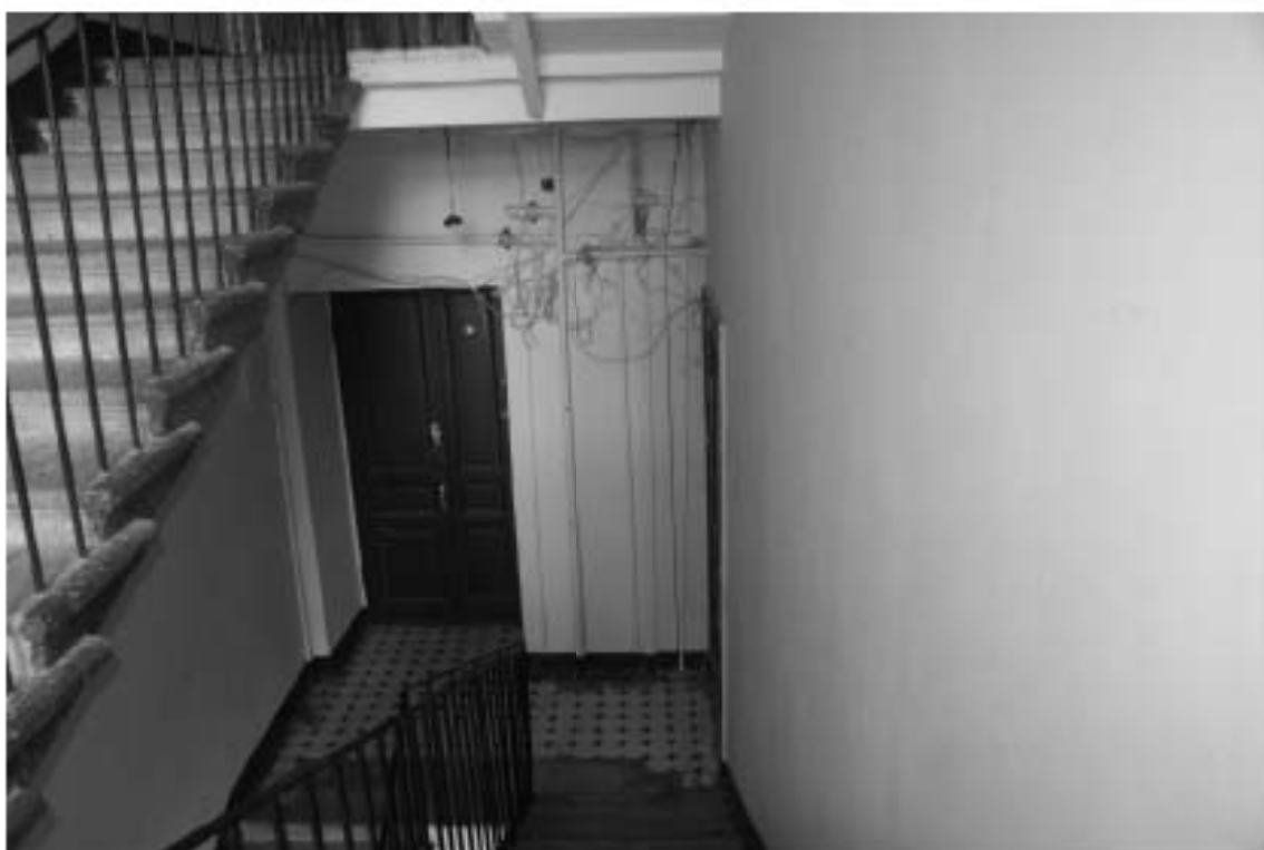
Фото 11. Лестница № 1: 4 этаж. Съемка 26.04.2021 г. Михайловская Г. В.
