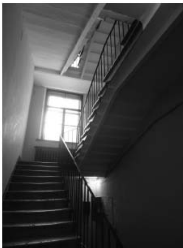
Фото 6. Лестница № 1: Площадка между 1 и 2 этажом. Съемка 26.04.2021 г. Михайловская Г. В.
