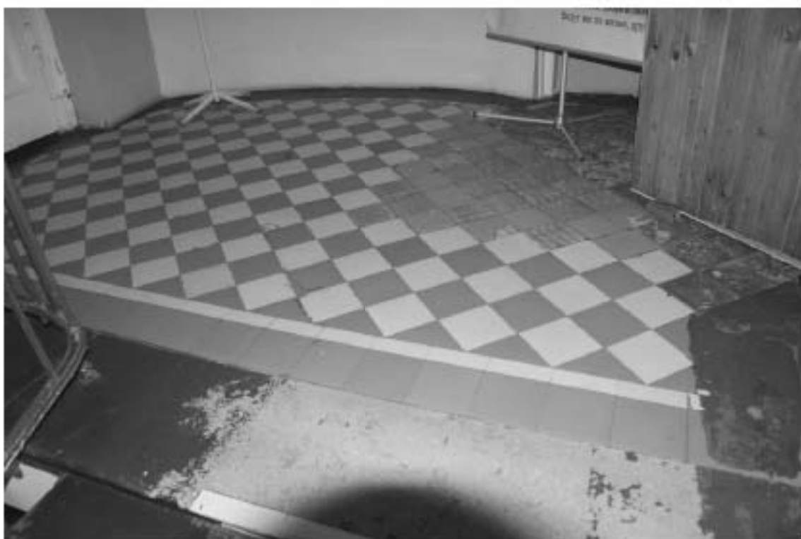
Фото 22. Лестница № 2: Площадка 2-го этажа. Съемка 26.04.2021 г. Михайловская Г. В.
