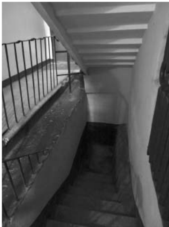
Фото 1. Лестница № 1: 1 этаж. Съемка 26.04.2021 г. Михайловская Г. В.
