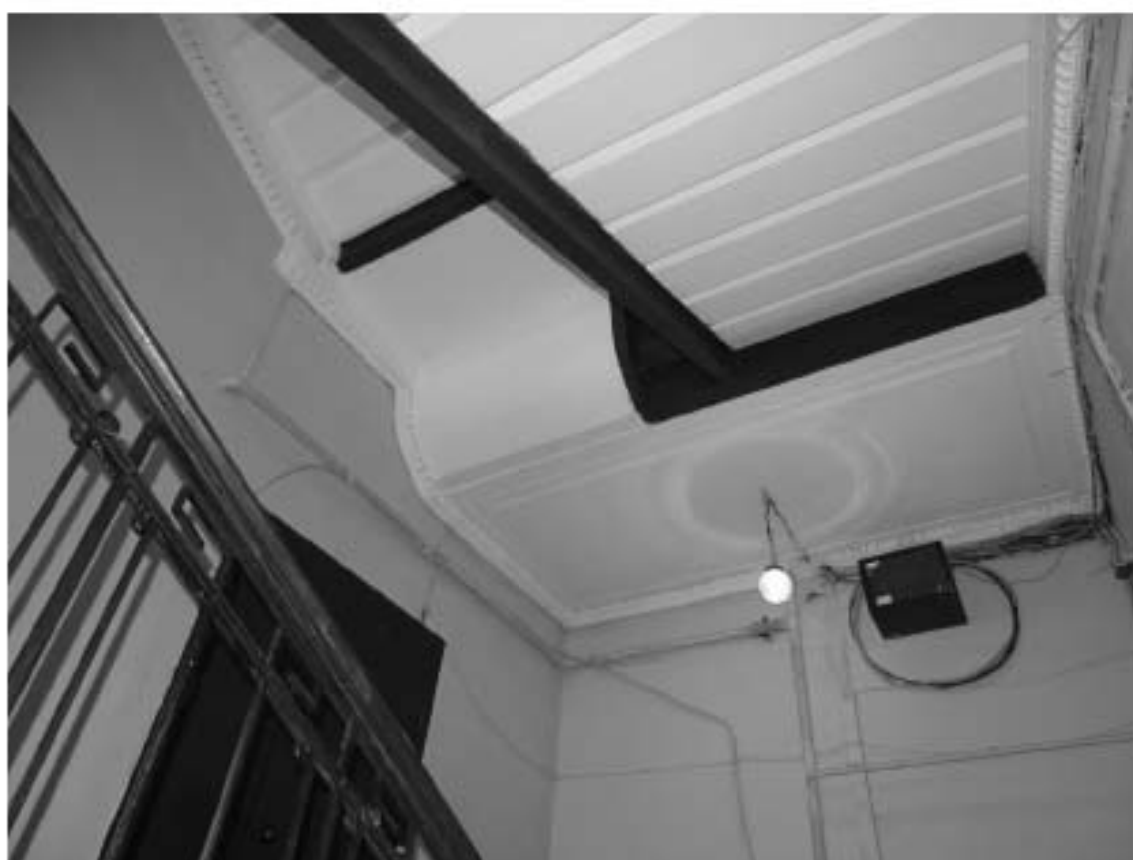
Фото 56. Лестница № 3: 2 этаж. Съемка 26.04.2021 г. Михайловская Г. В.
