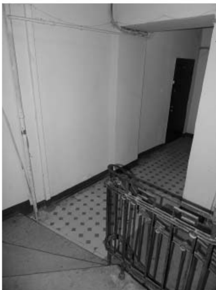
Фото 55. Лестница № 3: 2 этаж. Съемка 26.04.2021 г. Михайловская Г. В.
