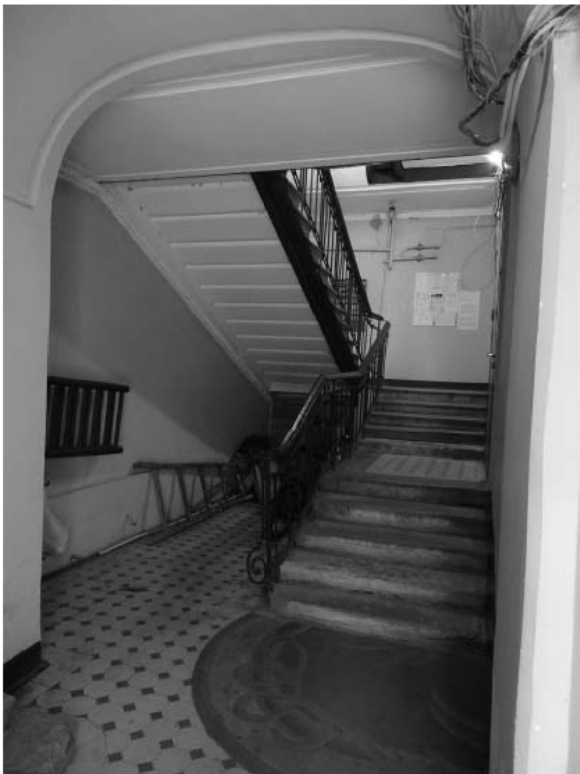
Фото 44. Лестница № 3: Вестибюль 1-го этажа. Съёмка 26.04.2021 г. Михайловская Г. В.
