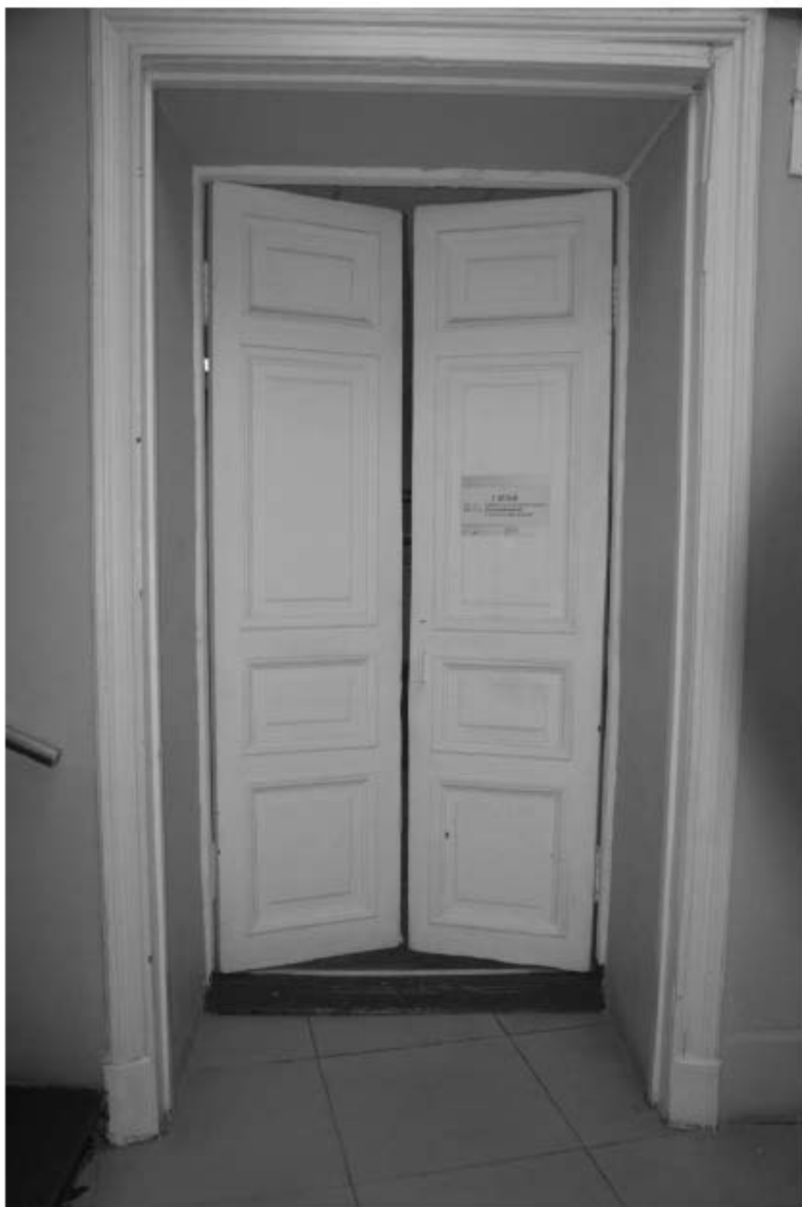
Фото 18. Лестница № 2: Площадка 1-го этажа. Оформление двери. Съемка 26.04.2021 г. Михайловская Г. В.
