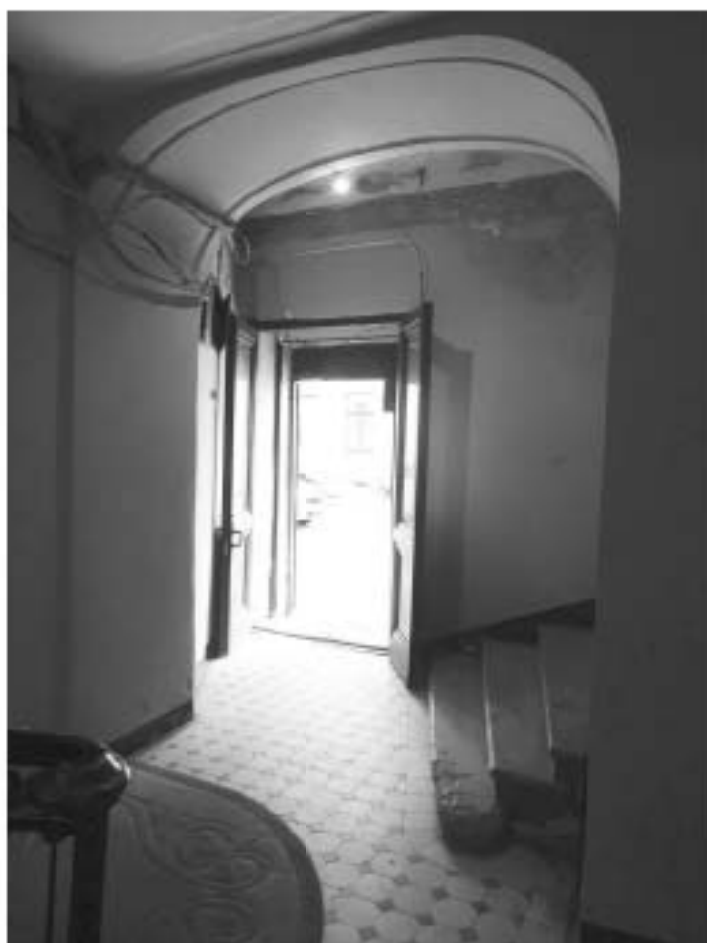
Фото 47. Лестница № 3: Вестибюль 1-го этажа. Съемка 26.04.2021 г. Михайловская Г. В.
