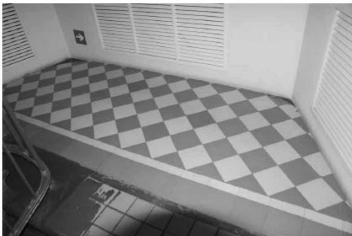
Фото 20. Лестница № 2: Площадка между 1-м и 2-м этажом. Покрытие пола. Съемка 26.04.2021 г. Михайловская Г. В.
