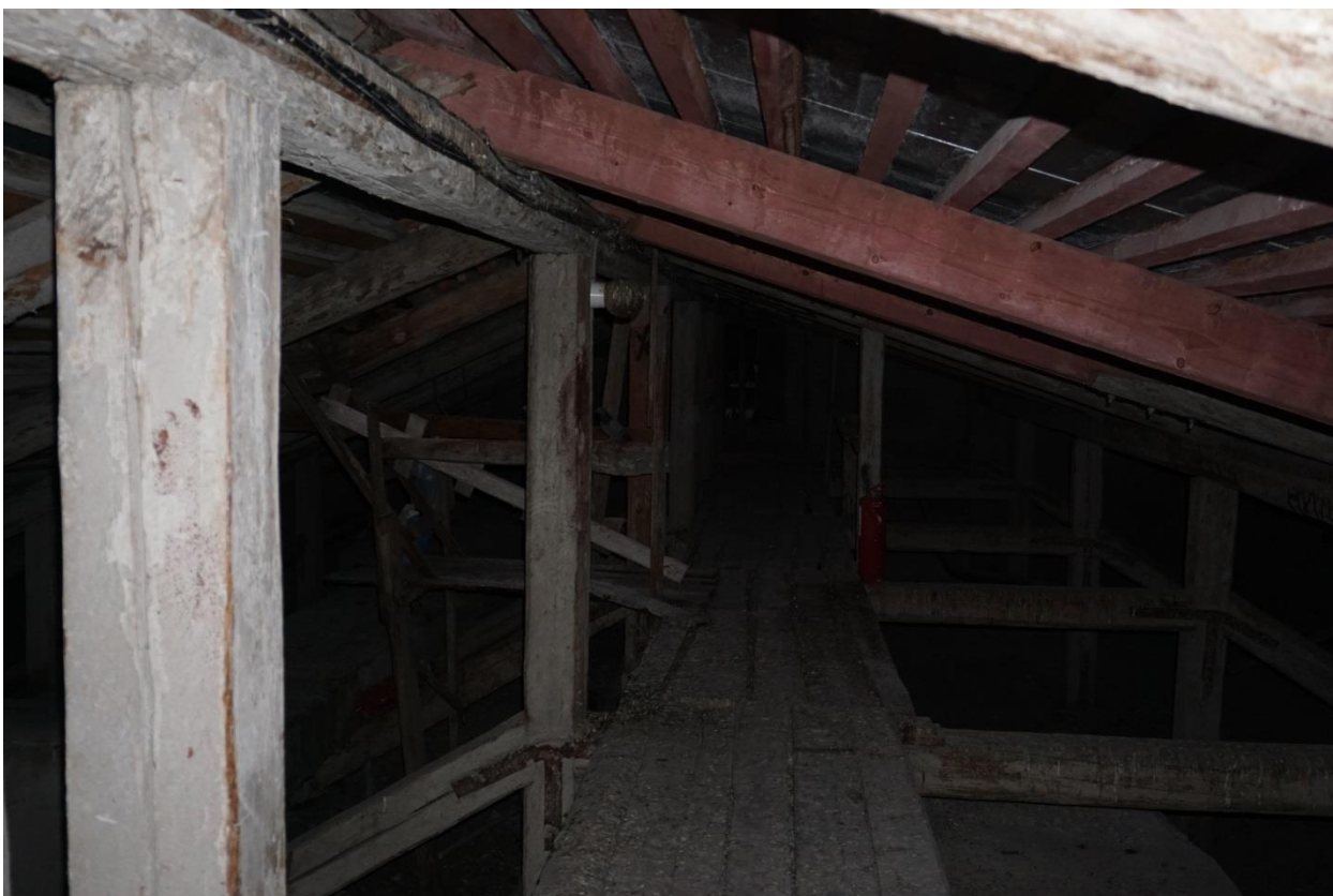
Фото 15. Чердачное пространство в восточной части восточного крыла. Вид с юга
