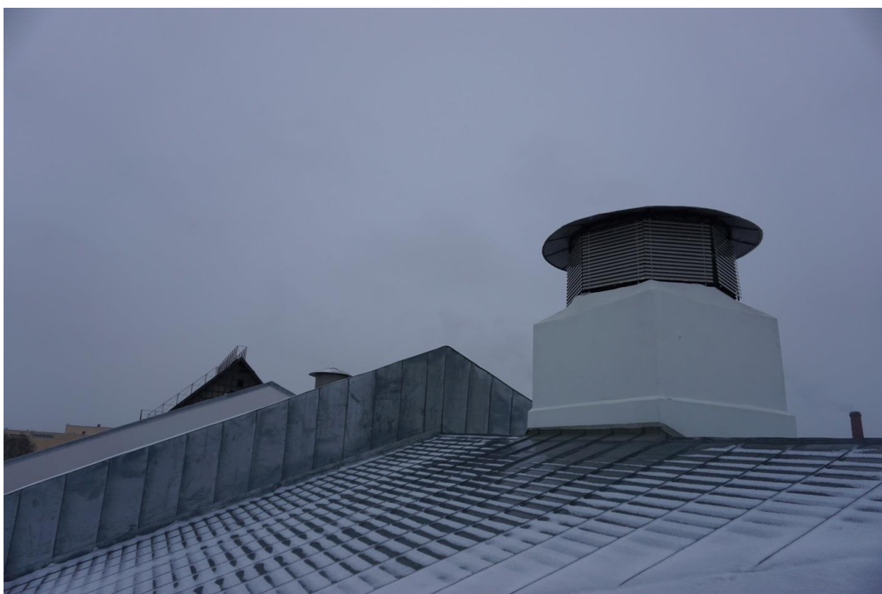
Фото 26. Кровля в центральной части Главного корпуса. Вид с юго-запада
