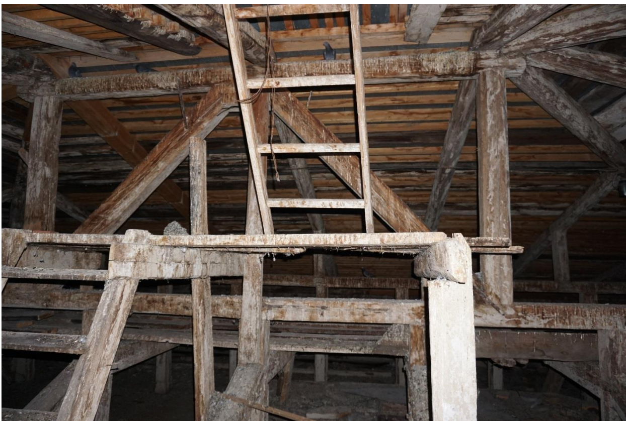
Фото 7. Чердачное пространство в юго-восточной части восточного крыла. Вид с севера
