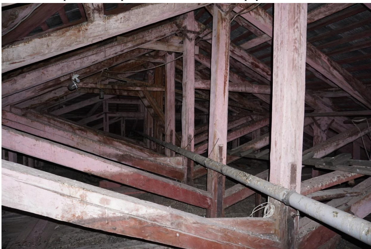
Фото 28. Чердачное пространство в центральной части Главного корпуса. Вид с юго-запада
