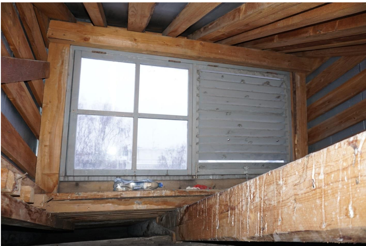
Фото 11. Чердачное пространство в юго-восточной части восточного крыла. Вид с юго-востока
