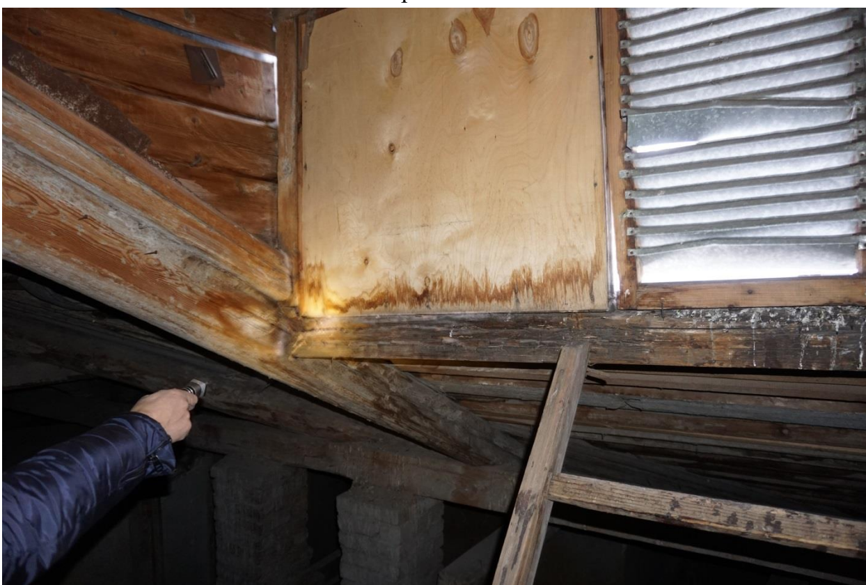
Фото 22. Чердачное пространство в центральной части восточного крыла. Вид с юго-востока
