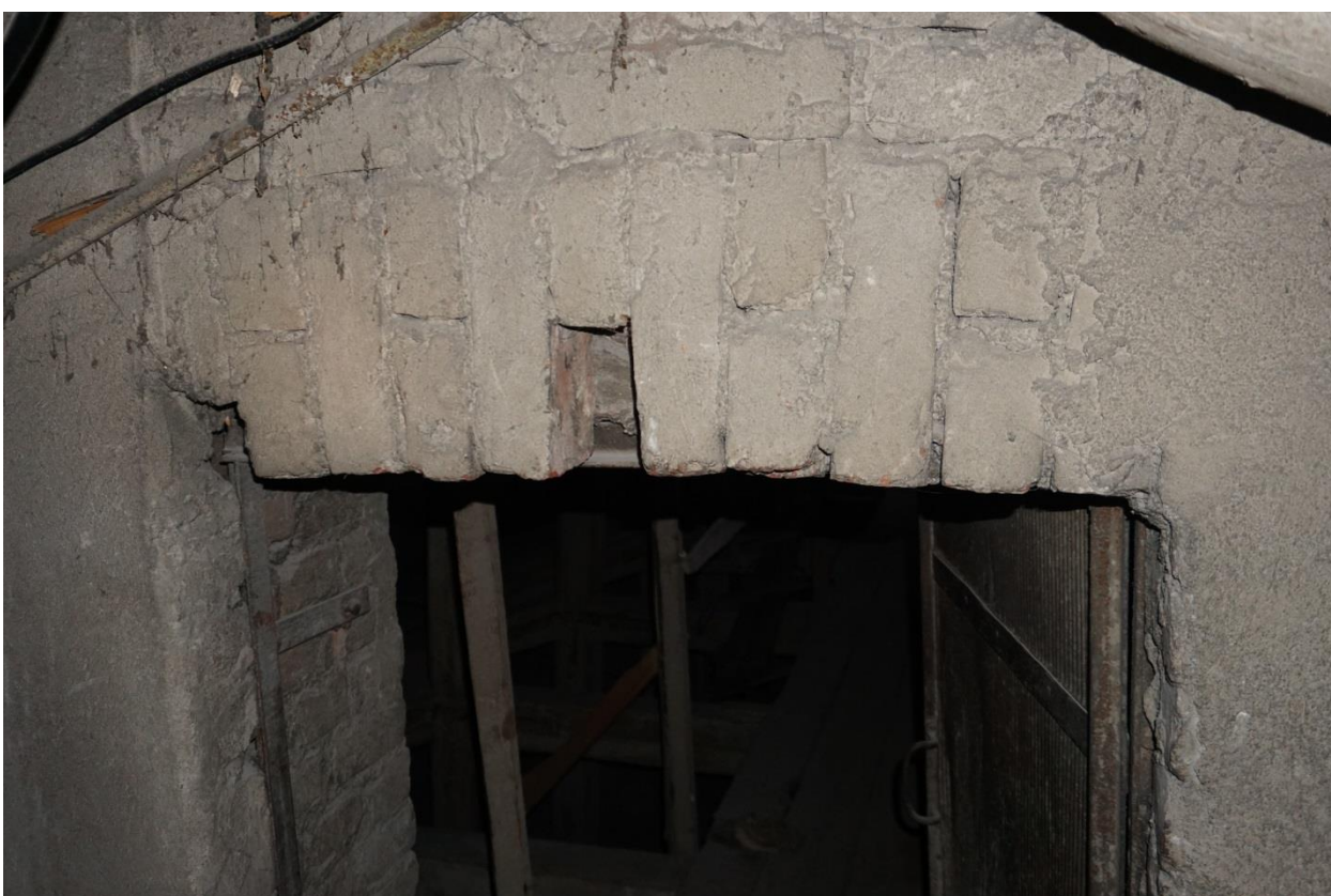
Фото 16. Чердачное пространство в восточной части восточного крыла. Вид с юго-востока
