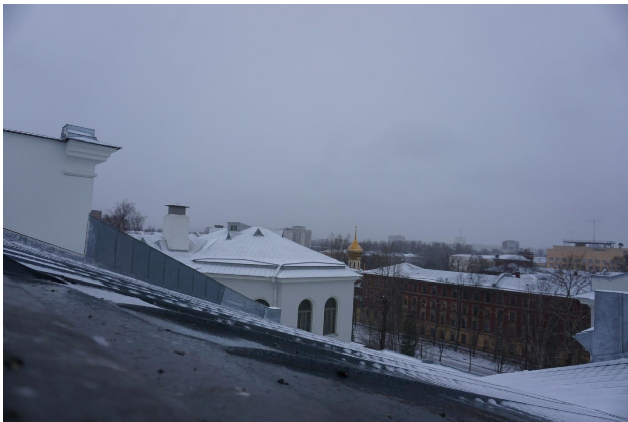
Фото 27. Кровля в центральной части Главного корпуса. Вид с юго-востока
