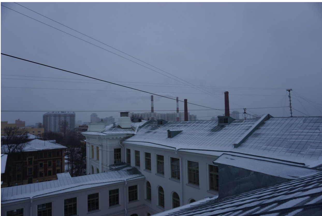
Фото 17. Кровля восточной части восточного крыла. Вид с юго-запада
