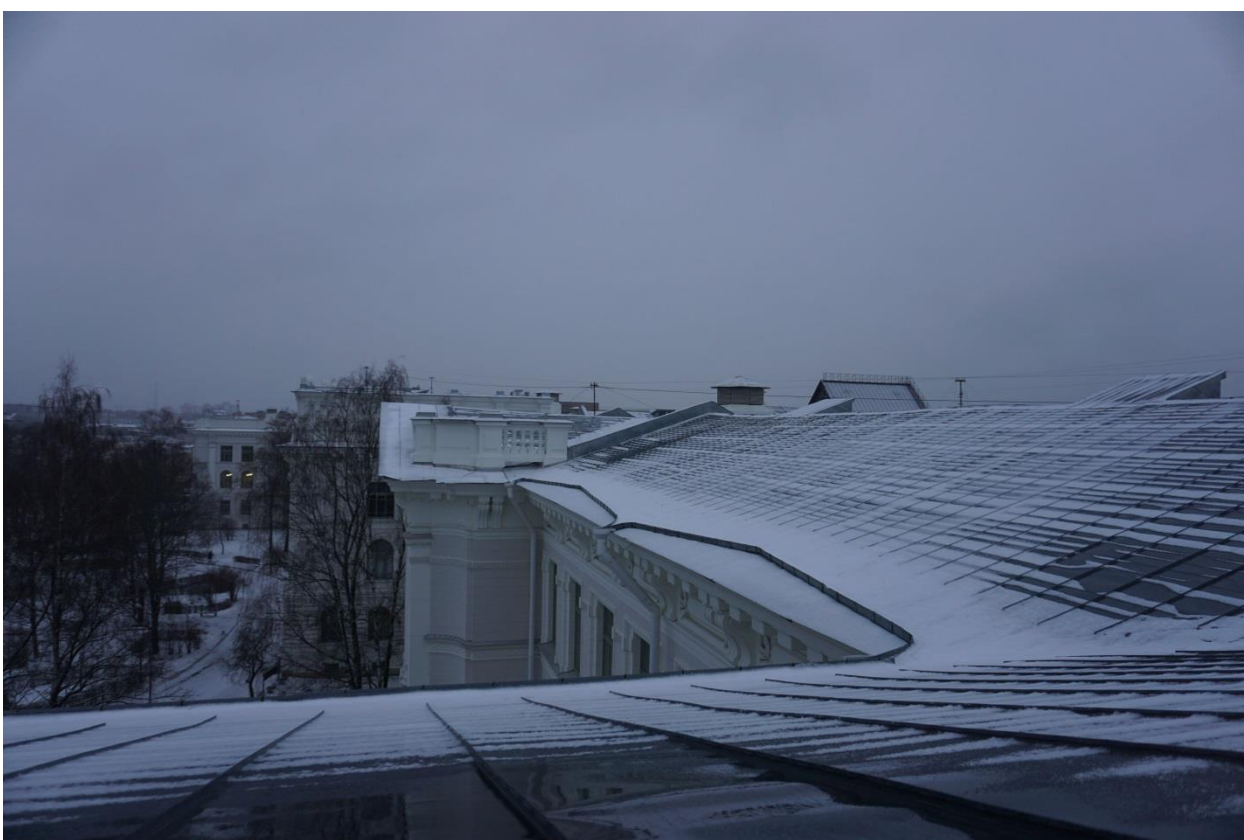
Фото 12. Кровля центральной части восточного крыла. Вид с юго-востока
