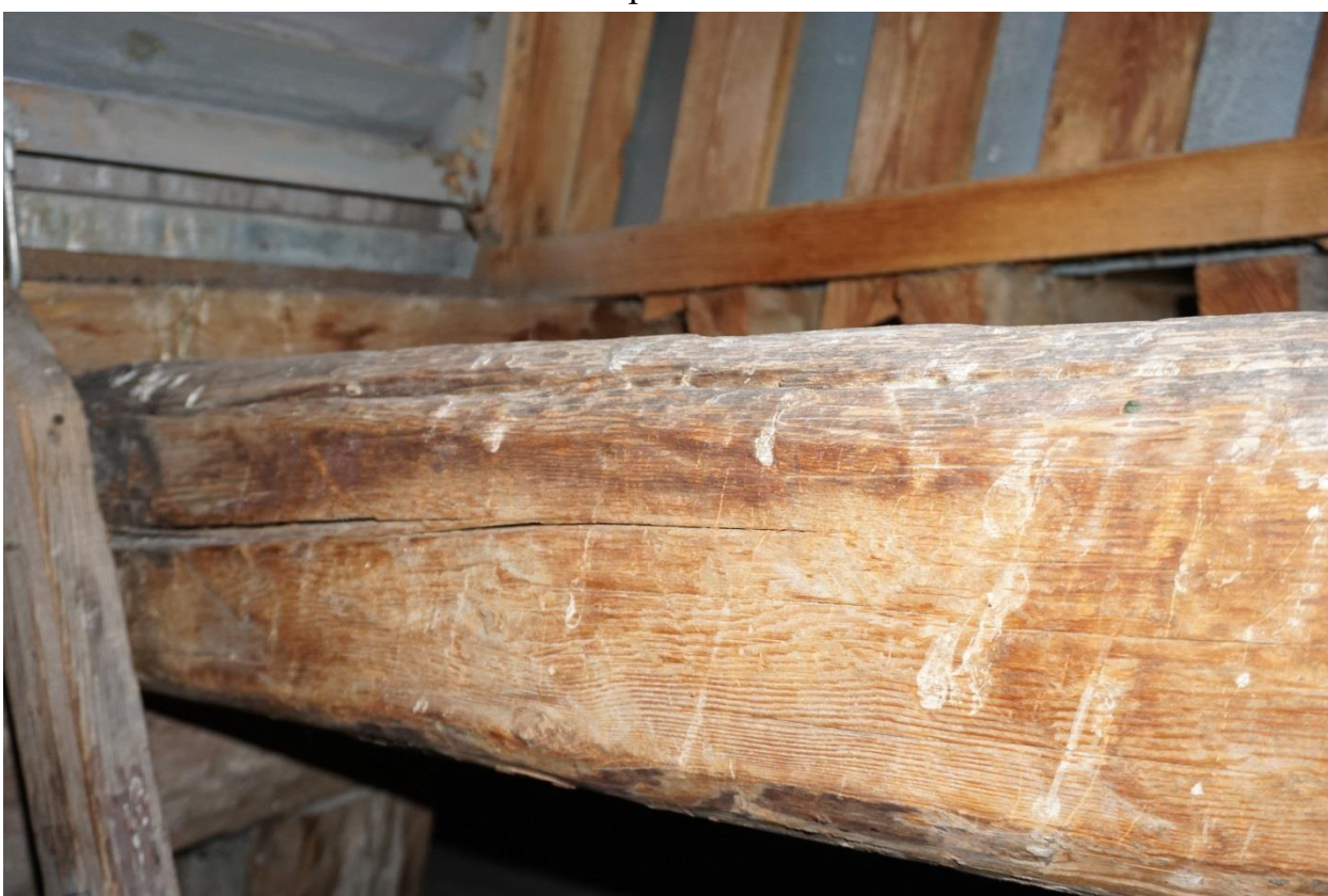
Фото 14. Чердачное пространство в юго-восточной части восточного крыла. Вид с юго-востока
