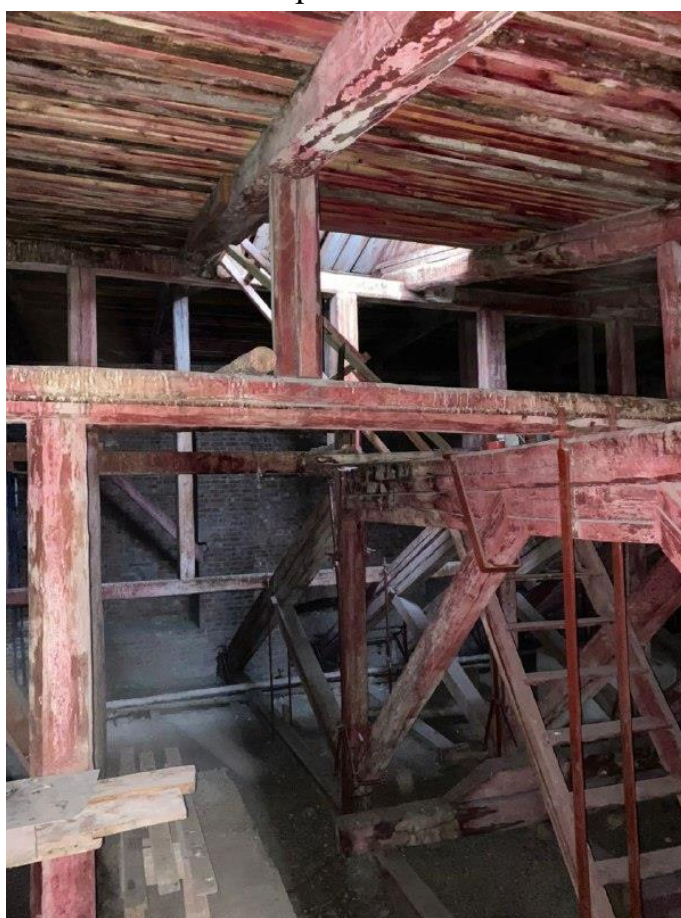
Фото 24. Чердачное пространство в центральной части Главного корпуса. Вид с востока
