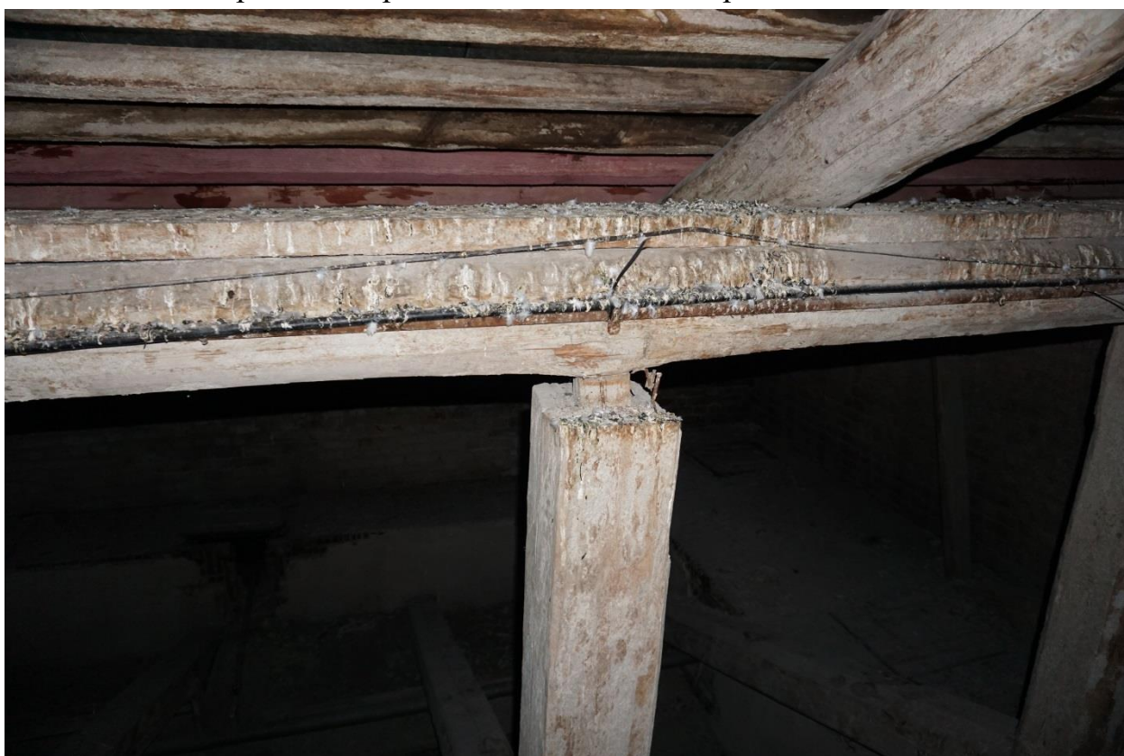
Фото 20. Чердачное пространство в центральной части восточного крыла. Вид с северо-востока
