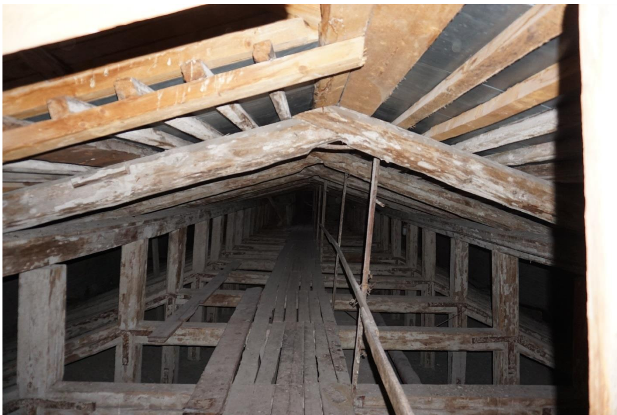
Фото 10. Чердачное пространство в юго-восточной части восточного крыла. Вид с юго-запада
