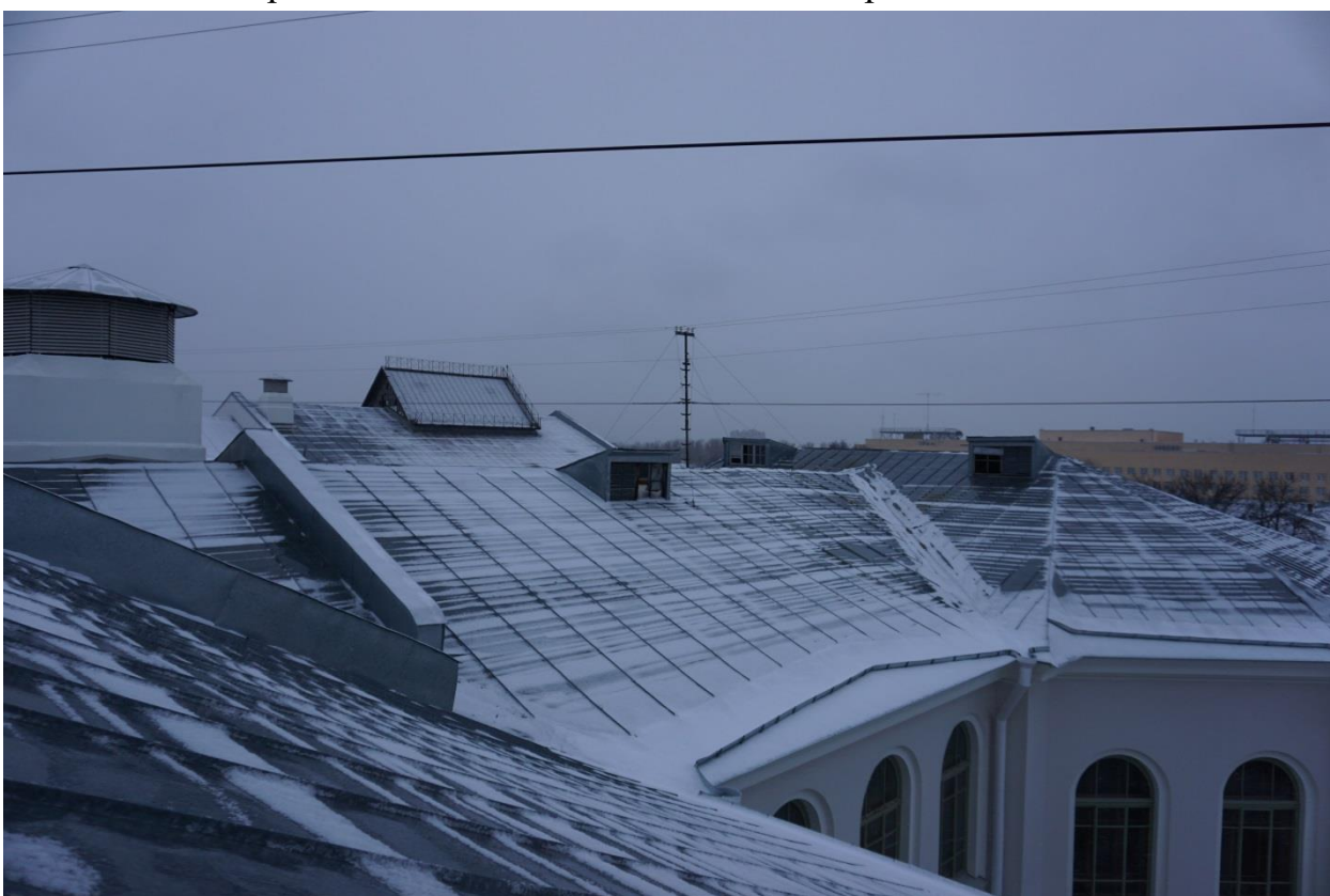
Фото 18. Кровля центральной части восточного крыла. Вид с юга
