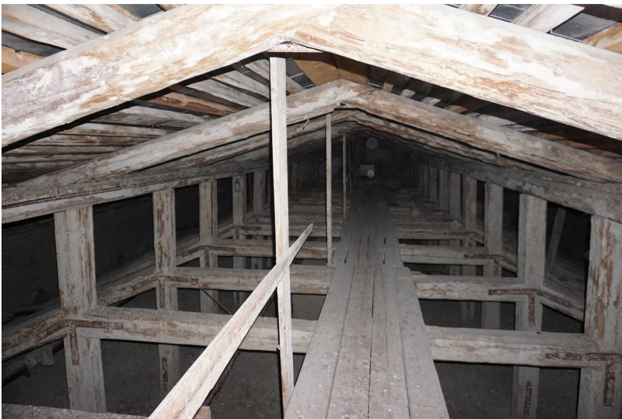
Фото 13. Чердачное пространство в юго-восточной части восточного крыла. Вид с северо-востока
