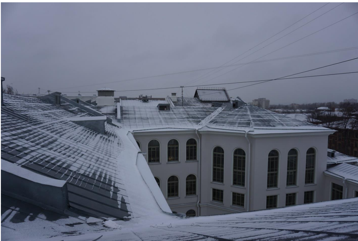
Фото 31. Кровля в центральной части восточного крыла. Вид с юго-востока
