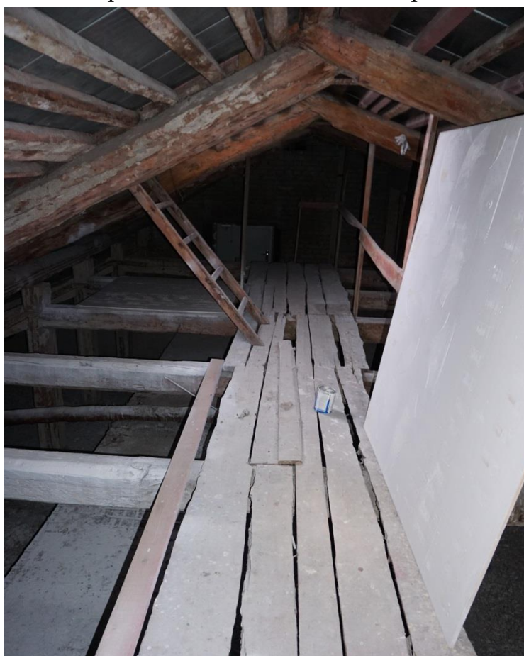
Фото 32. Чердачное пространство в северо-восточной части восточного крыла. Вид с юго-запада
