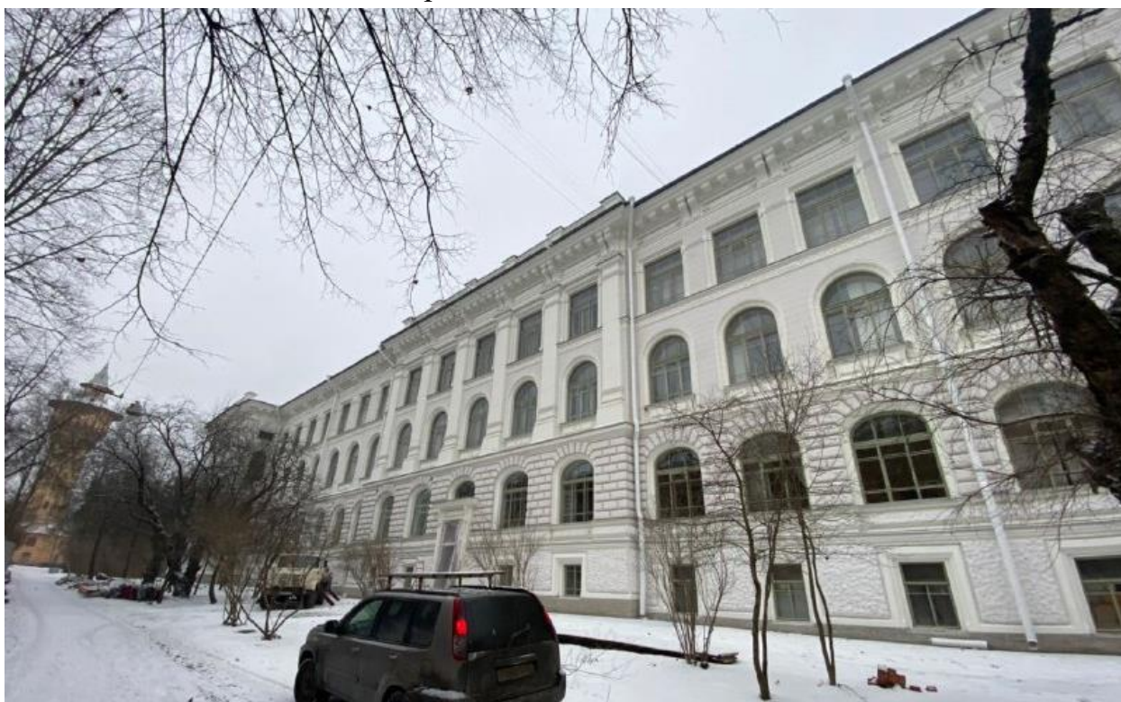
Фото 4. Восточный фасад восточного крыла. Вид с северо-востока
