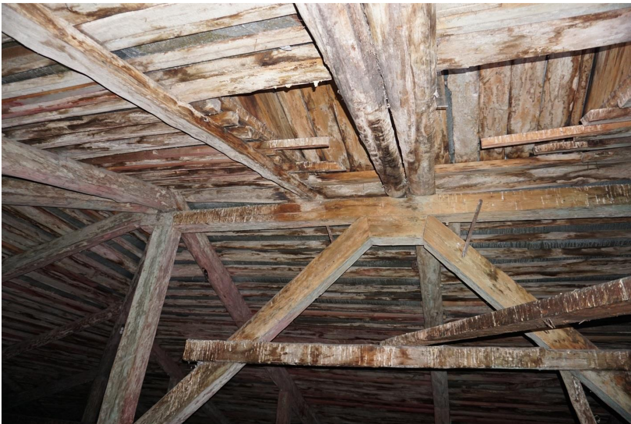
Фото 35. Чердачное пространство в северной части восточного крыла. Вид с юго-запада
