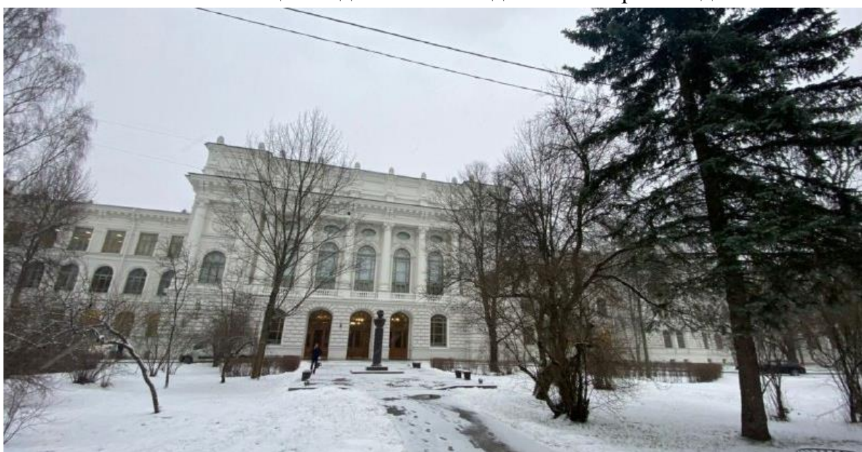
Фото 2. Центральная часть южного фасада Главного здания. Вид с юго-запада
