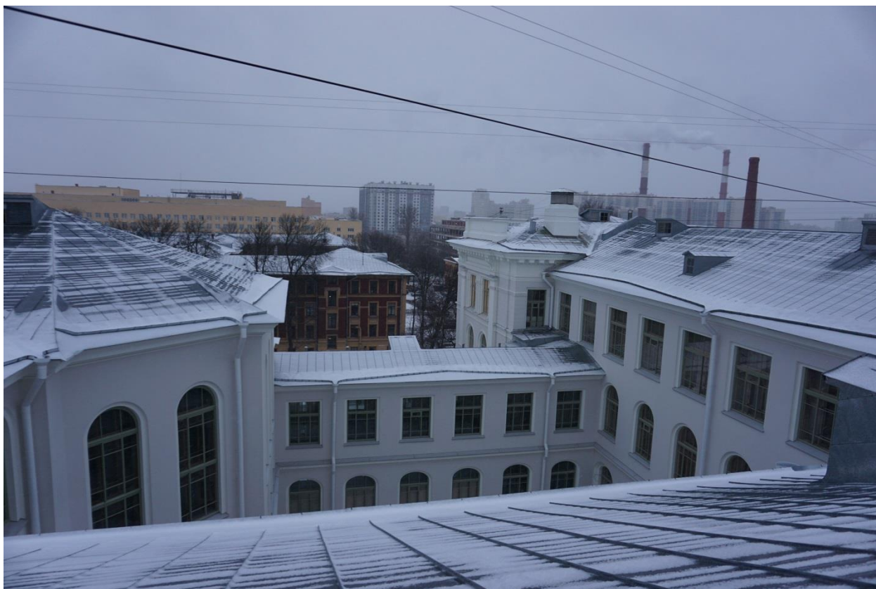
Фото 19. Кровля северной части восточного крыла. Вид с юго-запада
