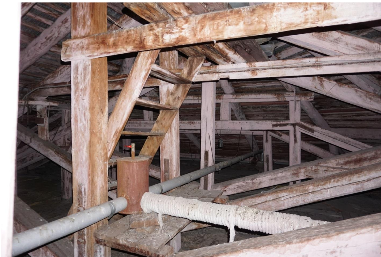
Фото 29. Чердачное пространство в северной части восточного крыла. Вид с юга
