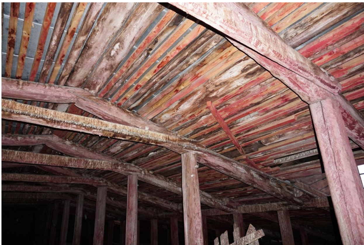
Фото 25. Чердачное пространство в центральной части Главного корпуса. Вид с юго-востока
