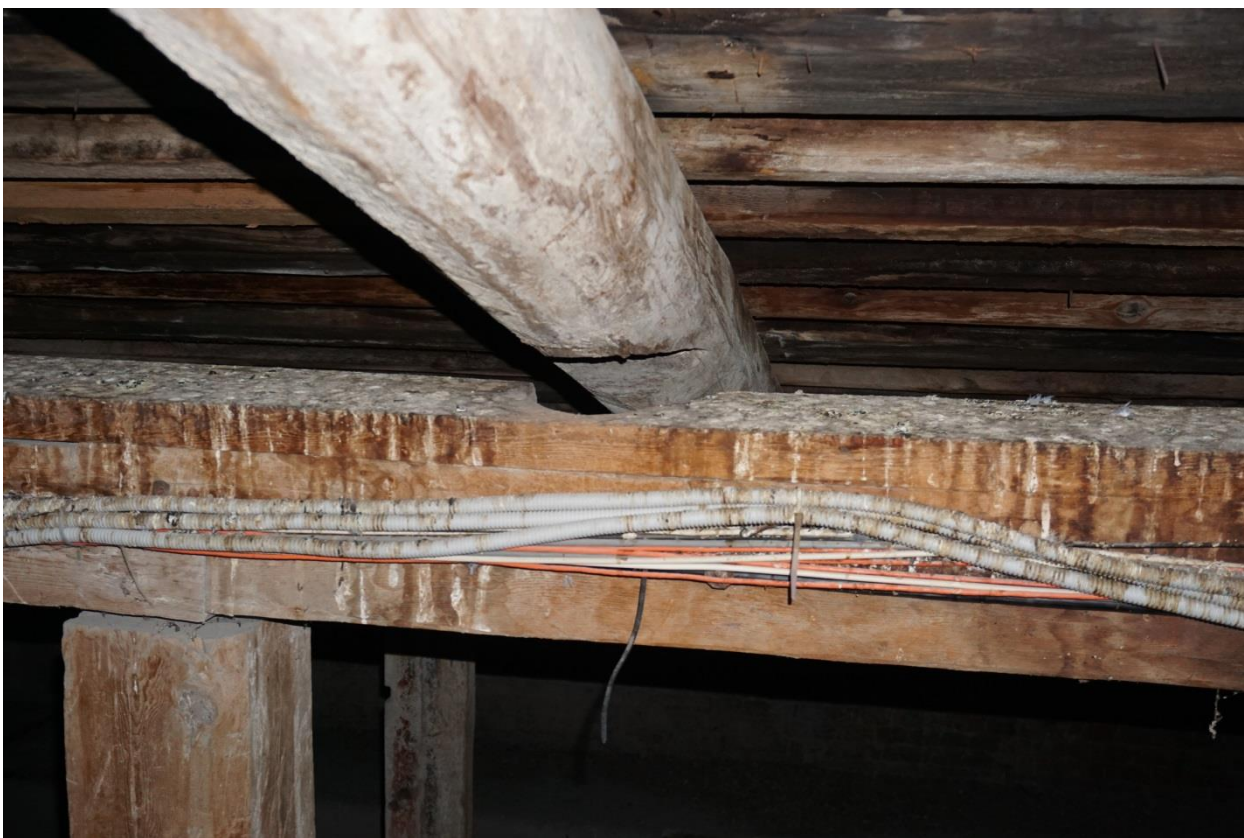
Фото 23. Чердачное пространство в центральной части восточного крыла. Вид с северо-востока
