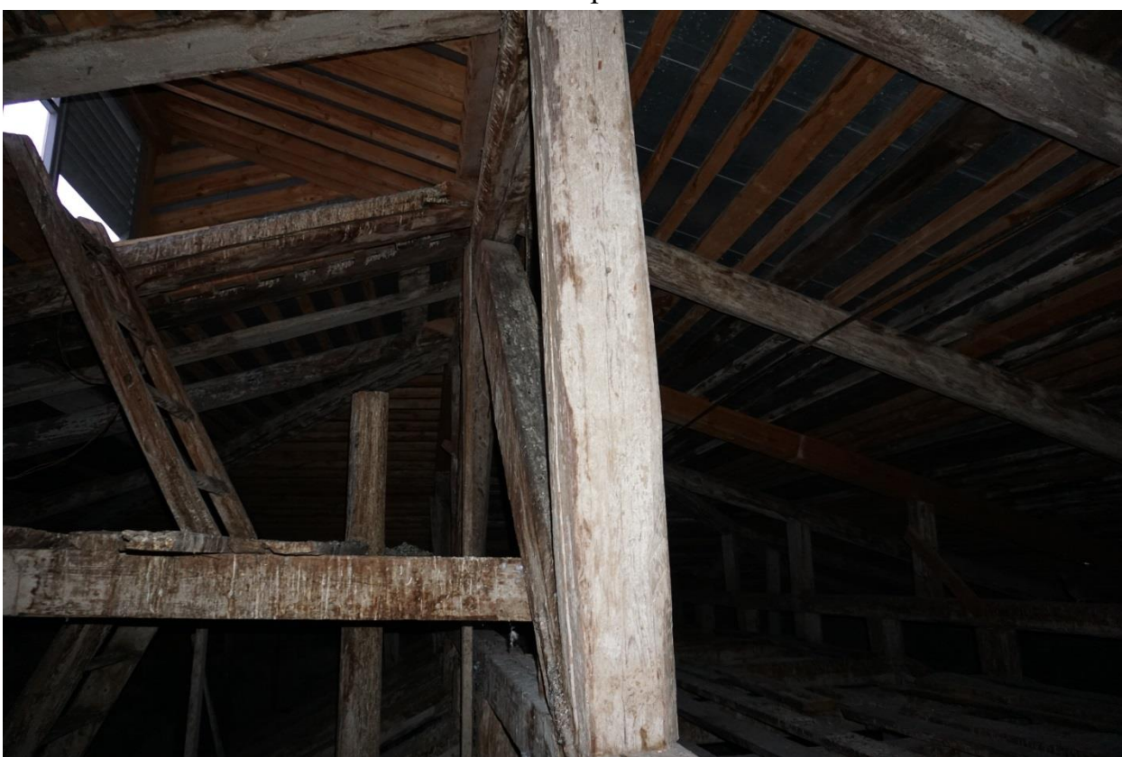
Фото 8. Чердачное пространство в юго-восточной части восточного крыла. Вид с северо-запада
