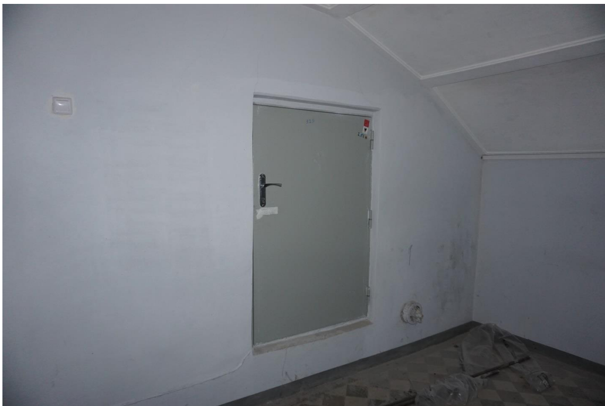
Фото 33. Вход на чердачное пространство в северо-восточной части восточного крыла. Вид с северо-востока
