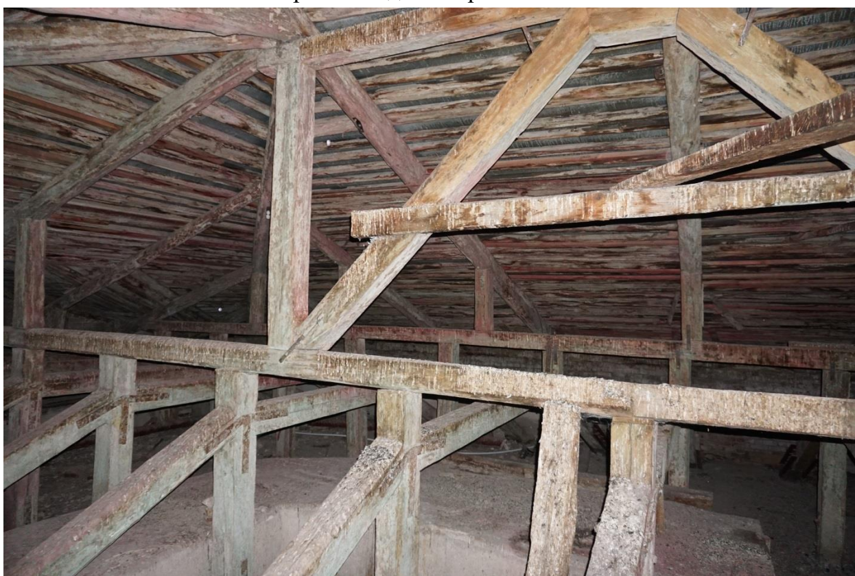
Фото 34. Чердачное пространство в северной части восточного крыла. Вид с юга
