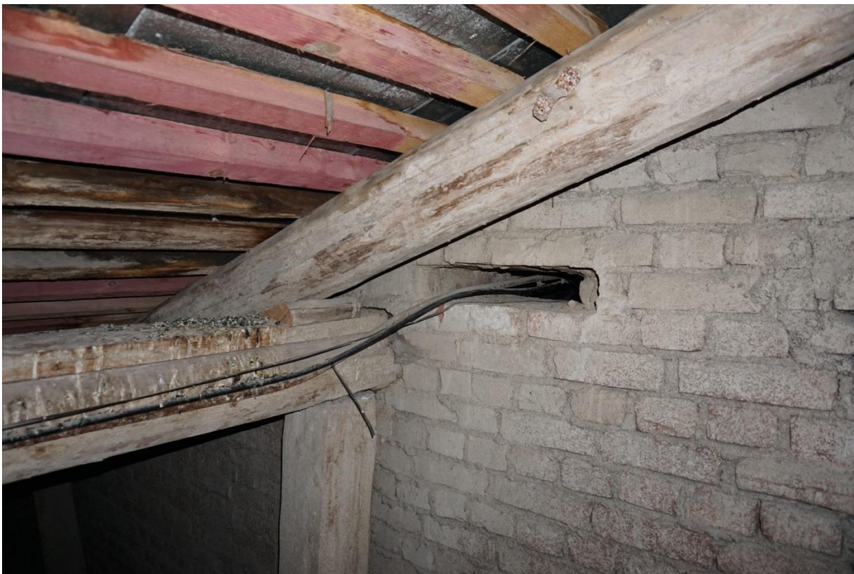
Фото 21. Чердачное пространство в центральной части восточного крыла. Вид с северо-востока
