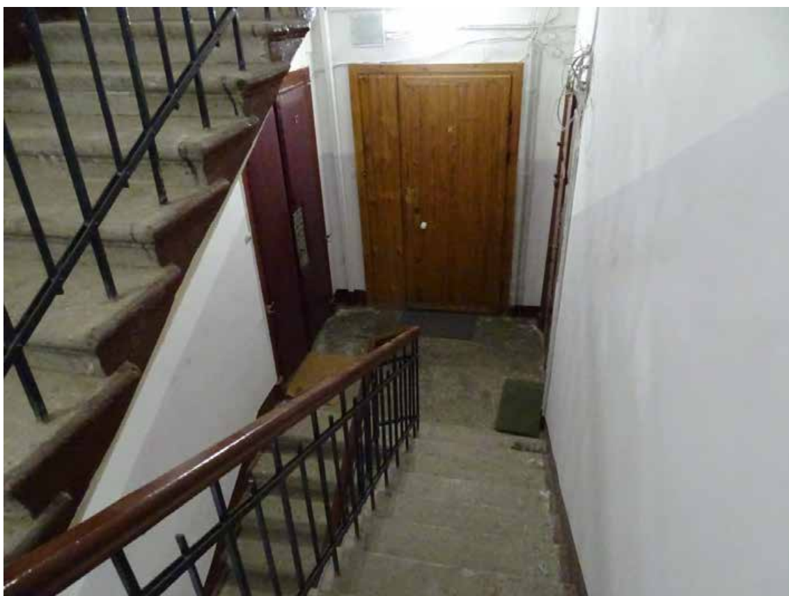
Фото 337. ЛК-2. Вид на площадку 6-го этажа. Съемка 19.04.2021 г. Трушковский В.Э.
