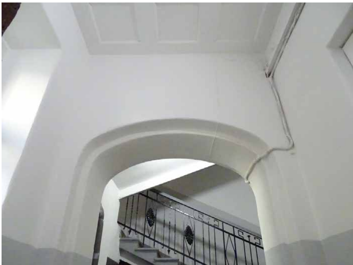
Фото 437. ЛК-6. Вестибюль 1-го этажа. Съемка 19.04.2021 г. Трушковский В.Э.
