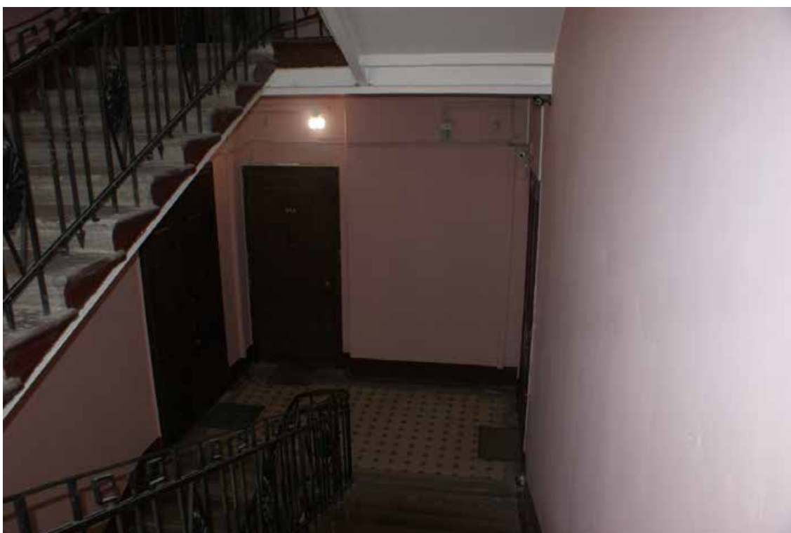
Фото 503. ЛК-8. Вид на площадку 4-го этажа. Съемка 19.04.2021 г. Трушковский В.Э.
