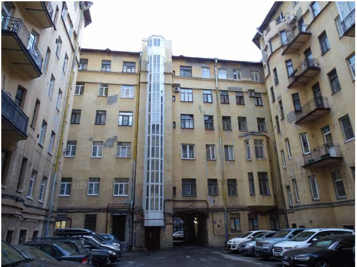
Фото 31. Здание по адресу: г. Санкт-Петербург, Большая Монетная ул., дом 29, литера А. Северный лицевой фасад. Съемка 19.04.2021 г. Трушковский В.Э.
