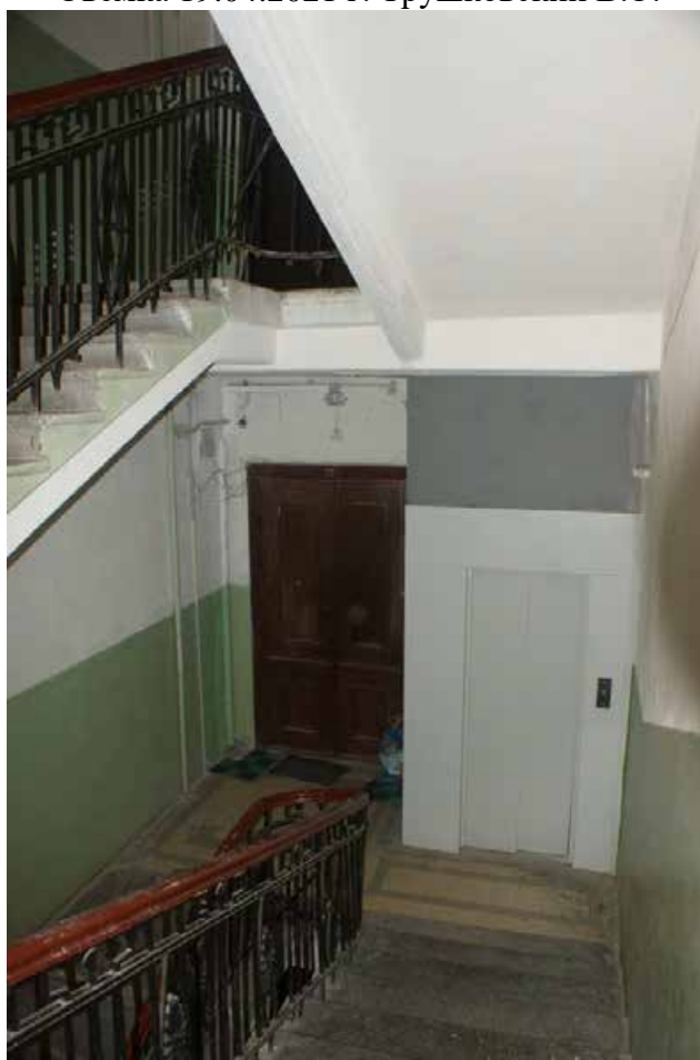
Фото 299. ЛК-1. Вид на площадку 4-го этажа. Съемка 19.04.2021 г. Трушковский В.Э.
