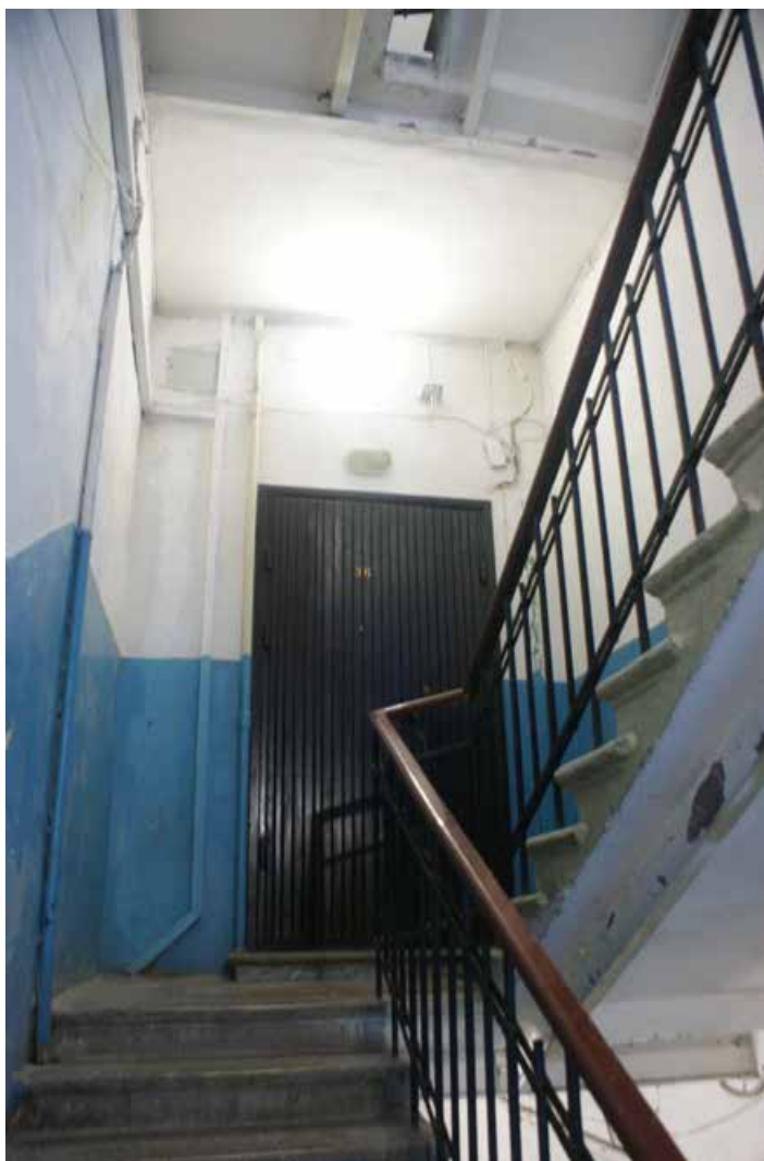
Фото 399. ЛК-5. Вид на площадку 2-го этажа. Съемка 19.04.2021 г. Трушковский В.Э.
