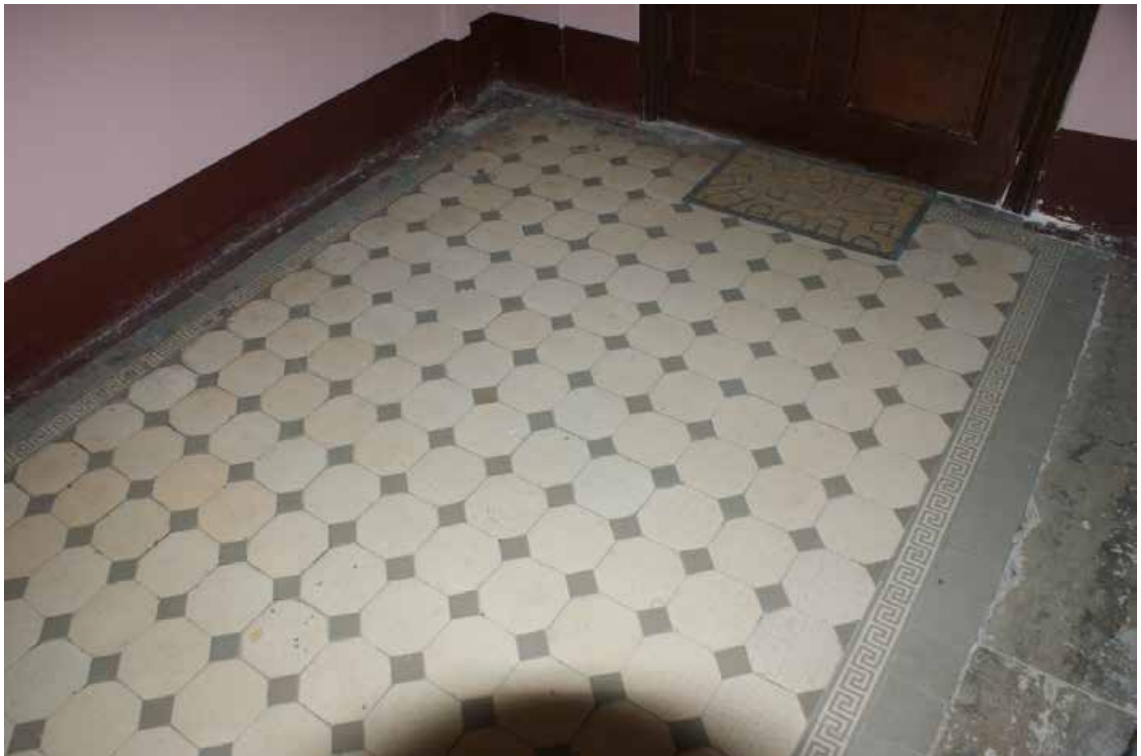
Фото 504. ЛК-8. Площадка 4-го этажа. Покрытие пола. Съемка 19.04.2021 г. Трушковский В.Э.
