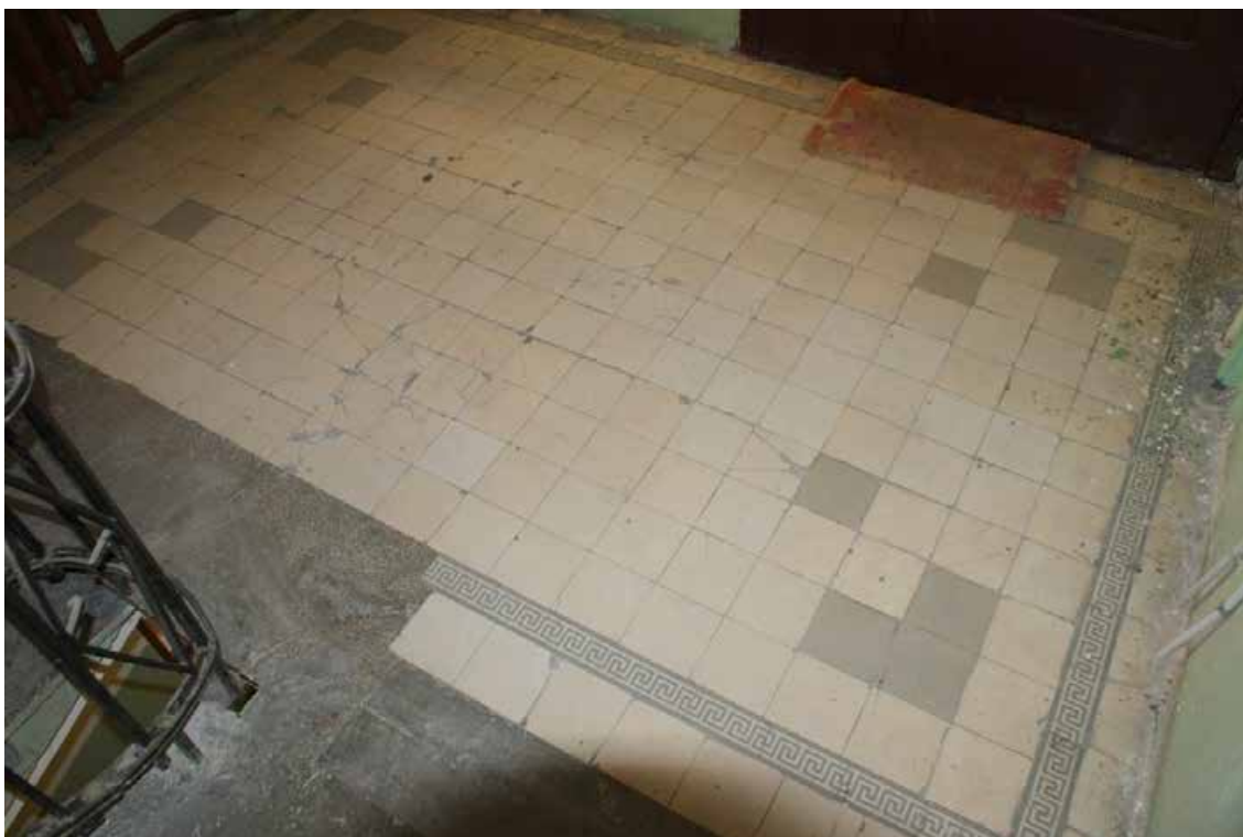
Фото 302. ЛК-1. Площадка между 4-м и 5-м этажом. Покрытие пола. Съемка 19.04.2021 г. Трушковский В.Э.
