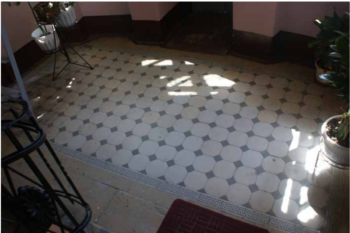
Фото 511. ЛК-8. Площадка между 5-м и 6-м этажом. Покрытие пола. Съемка 19.04.2021 г. Трушковский В.Э.
