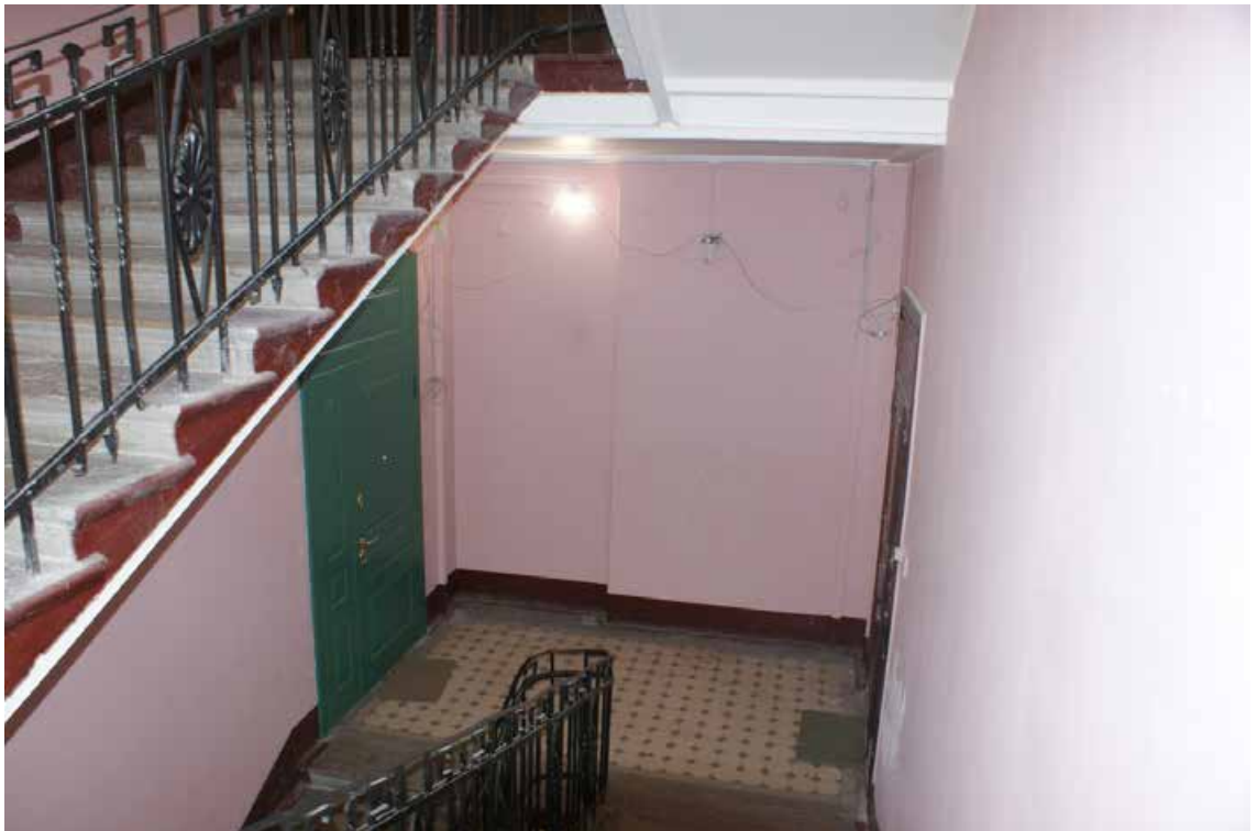
Фото 500. ЛК-8. Вид на площадку 3-го этажа. Съемка 19.04.2021 г. Трушковский В.Э.
