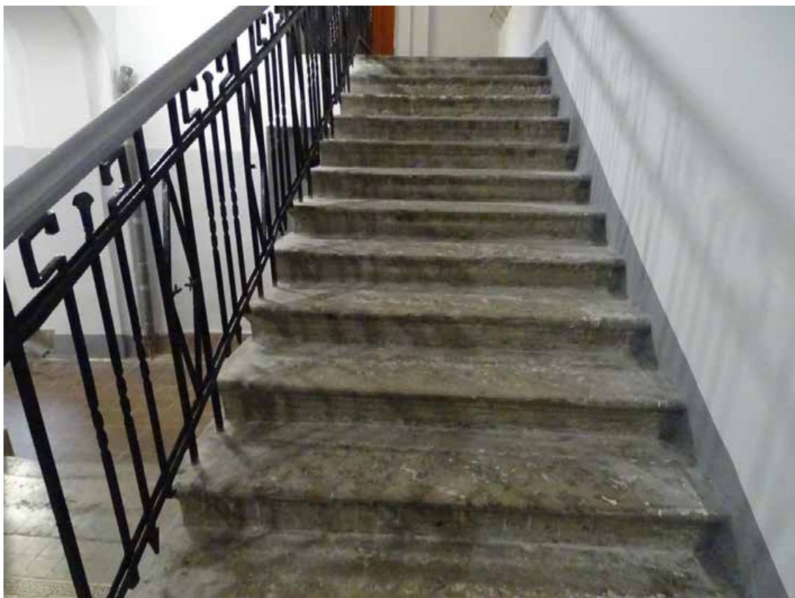
Фото 445. ЛК-6. Площадка 1-го этажа. Лестница. Съемка 19.04.2021 г. Трушковский В.Э.
