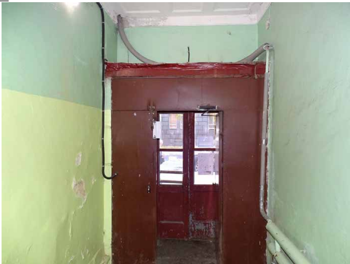
Фото 272. ЛК-1. Вестибюль 1-го этажа. Входная дверь. Съемка 19.04.2021 г. Трушковский В.Э.
