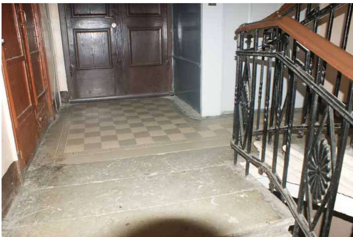
Фото 371. ЛК-3. Площадка 4-го этажа. Съемка 19.04.2021 г. Трушковский В.Э.
