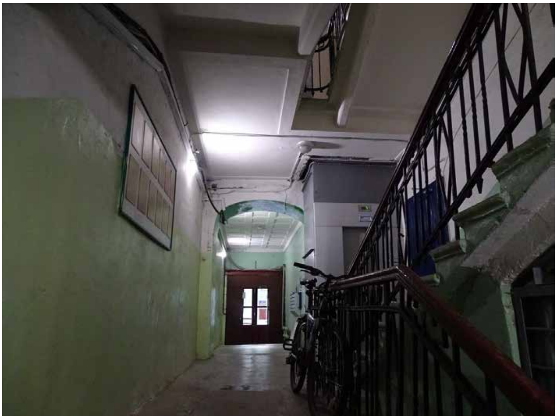
Фото 281. ЛК-1. Площадка 1-го этажа. Съемка 19.04.2021 г. Трушковский В.Э.
