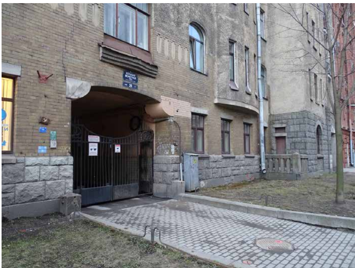
Фото 20. Здание по адресу: г. Санкт-Петербург, Большая Монетная ул., дом 29, литера А. Фрагмент фасада по Большой Монетной ул. Воротный проезд. Съемка 19.04.2021 г. Трушковский В.Э.
