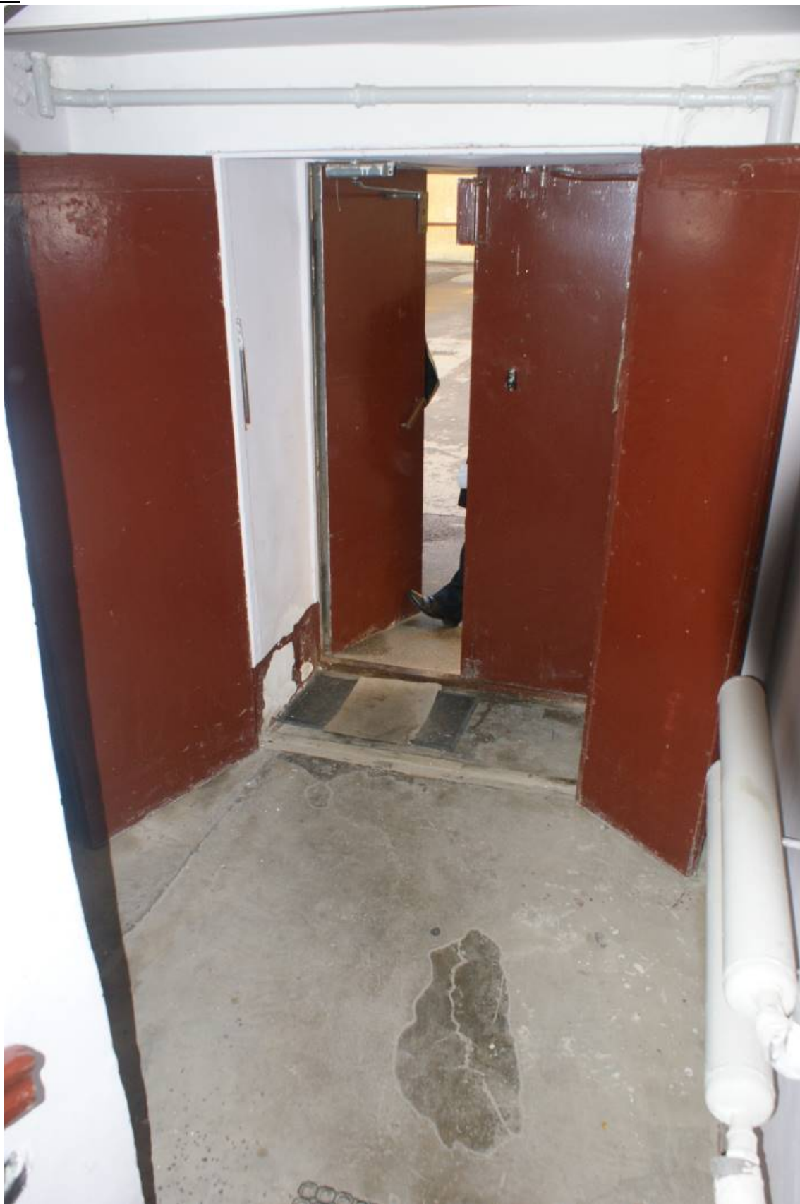
Фото 311. ЛК-2. Вестибюль 1-го этажа. Входная дверь. Съемка 19.04.2021 г. Трушковский В.Э.
