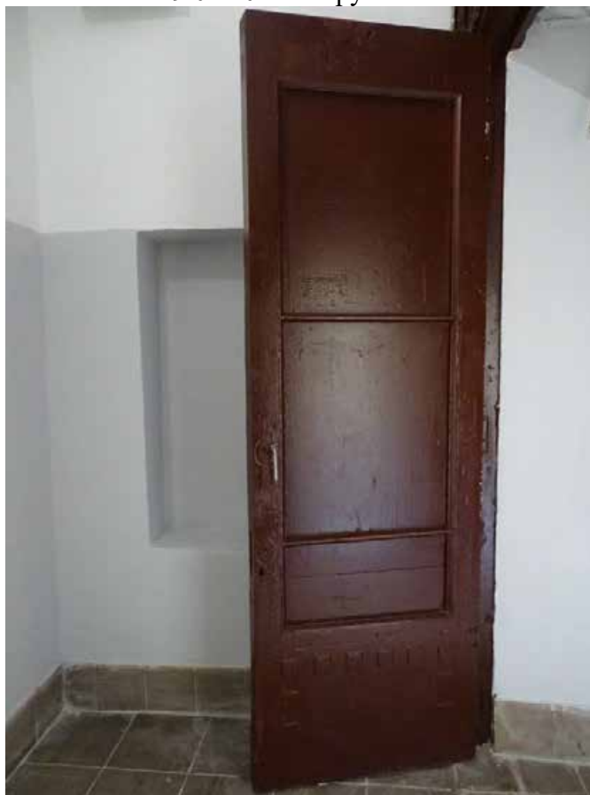
Фото 431. ЛК-6. Вестибюль 1-го этажа. Входная дверь. Съемка 19.04.2021 г. Трушковский В.Э.
