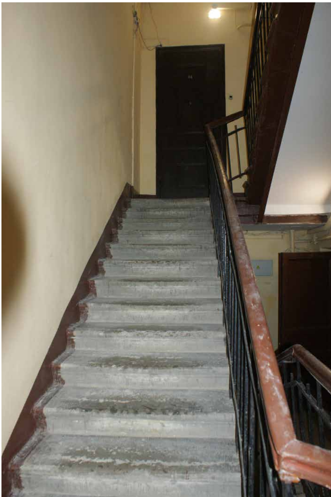
Фото 520. ЛК-9. Вид на площадку 2-го этажа. Съемка 19.04.2021 г. Трушковский В.Э.
