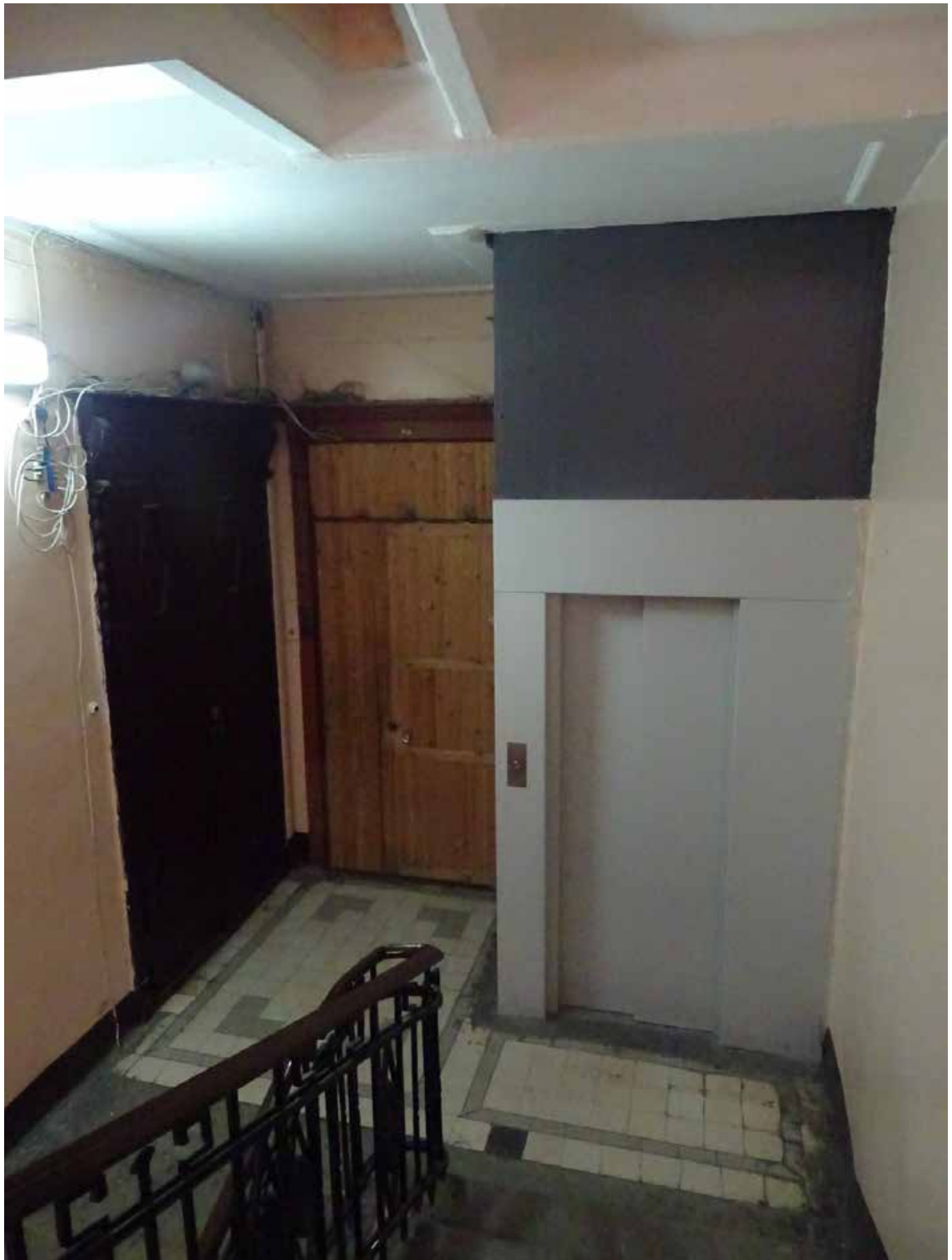
Фото 362. ЛК-3. Площадка 3-го этажа. Съемка 19.04.2021 г. Трушковский В.Э.
