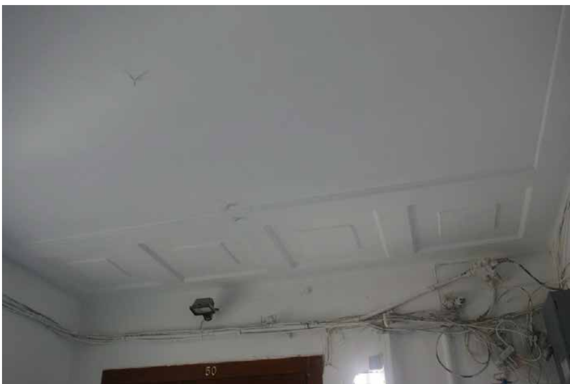
Фото 478. ЛК-6. Вид на площадку между 6-м и чердачным этажом. Оформление потолка. Съемка 19.04.2021 г. Трушковский В.Э.
