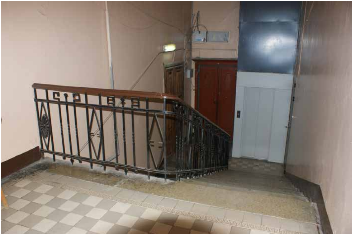
Фото 381. ЛК-3. Вид на площадку 6-го этажа. Съемка 19.04.2021 г. Трушковский В.Э.
