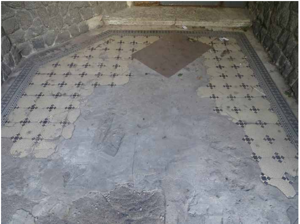
Фото 17. Здание по адресу: г. Санкт-Петербург, Большая Монетная ул., дом 29, литера А. Фрагмент фасада по Большой Монетной ул. Покрытие пола. Съемка 19.04.2021 г. Трушковский В.Э.
