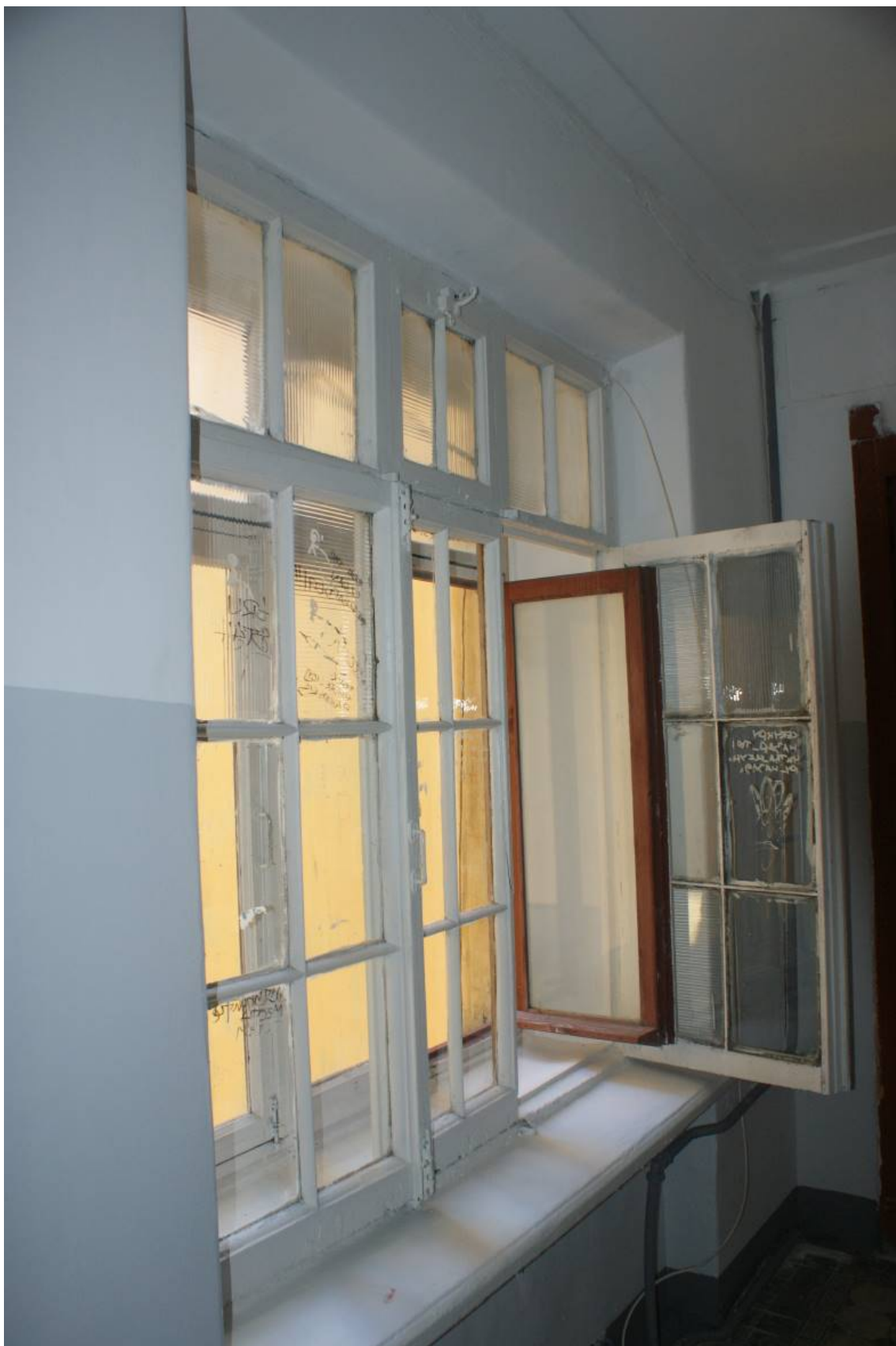
Фото 466. ЛК-6. Площадка между 4-м и 5-м этажом. Оформление окна. Съемка 19.04.2021 г. Трушковский В.Э.
