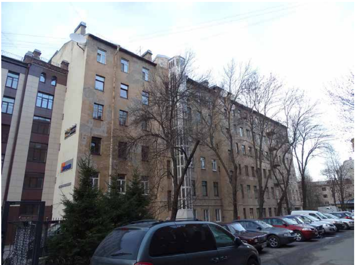
Фото 40. Здание по адресу: г. Санкт-Петербург, Большая Монетная ул., дом 29, литера А. Южный дворовой фасад. Съемка 19.04.2021 г. Трушковский В.Э.
