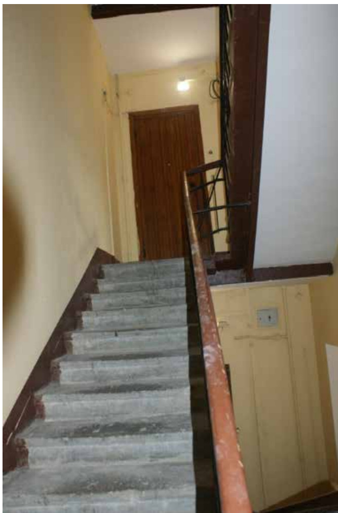
Фото 528. ЛК-9. Вид на площадку 4-го этажа. Съемка 19.04.2021 г. Трушковский В.Э.
