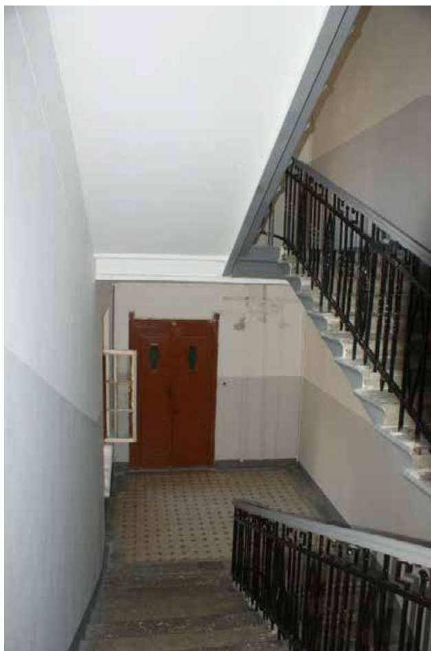
Фото 464. ЛК-6. Вид на площадку между 4-м и 5-м этажом. Съемка 19.04.2021 г. Трушковский В.Э.
