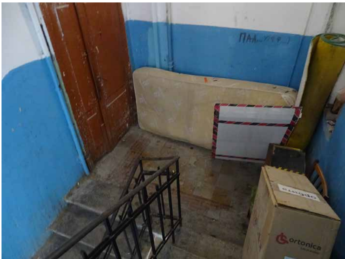
Фото 418. ЛК-5. Площадка 5-го этажа. Съемка 19.04.2021 г. Трушковский В.Э.
