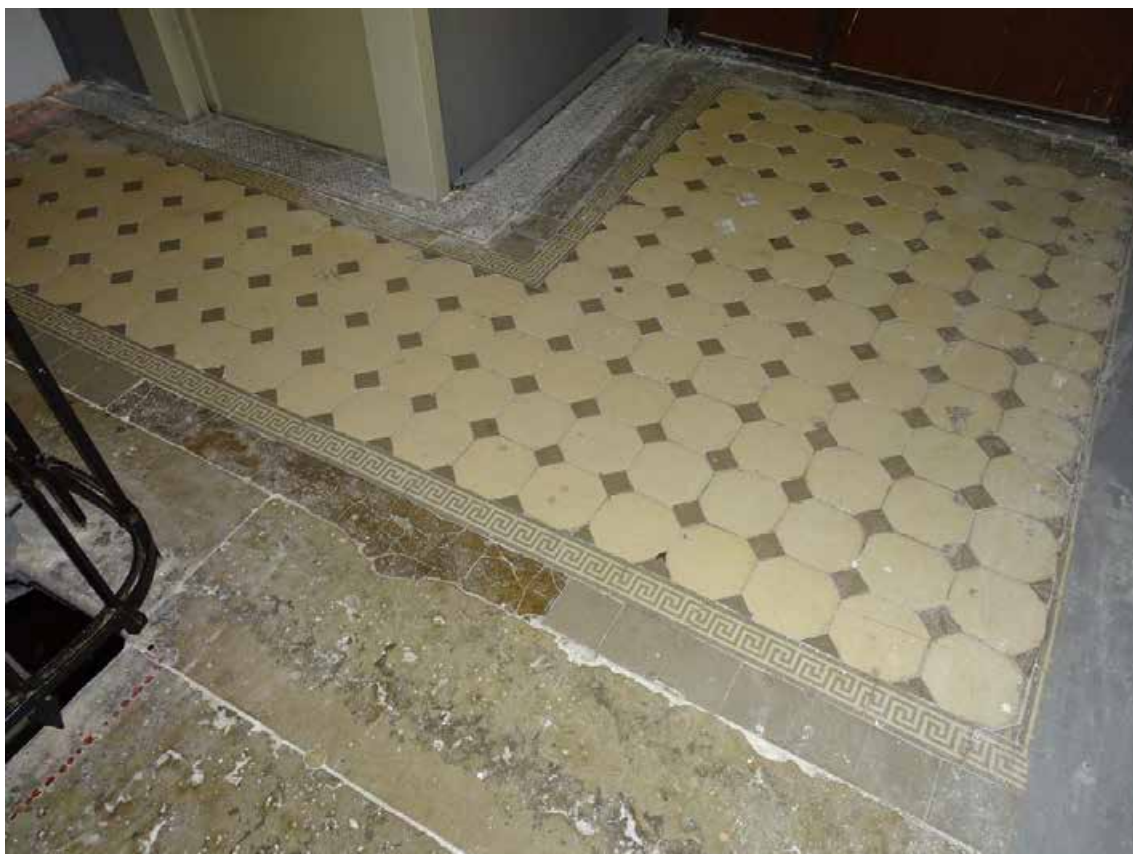
Фото 462. ЛК-6. Площадка 4-го этажа. Покрытие пола. Съемка 19.04.2021 г. Трушковский В.Э.
