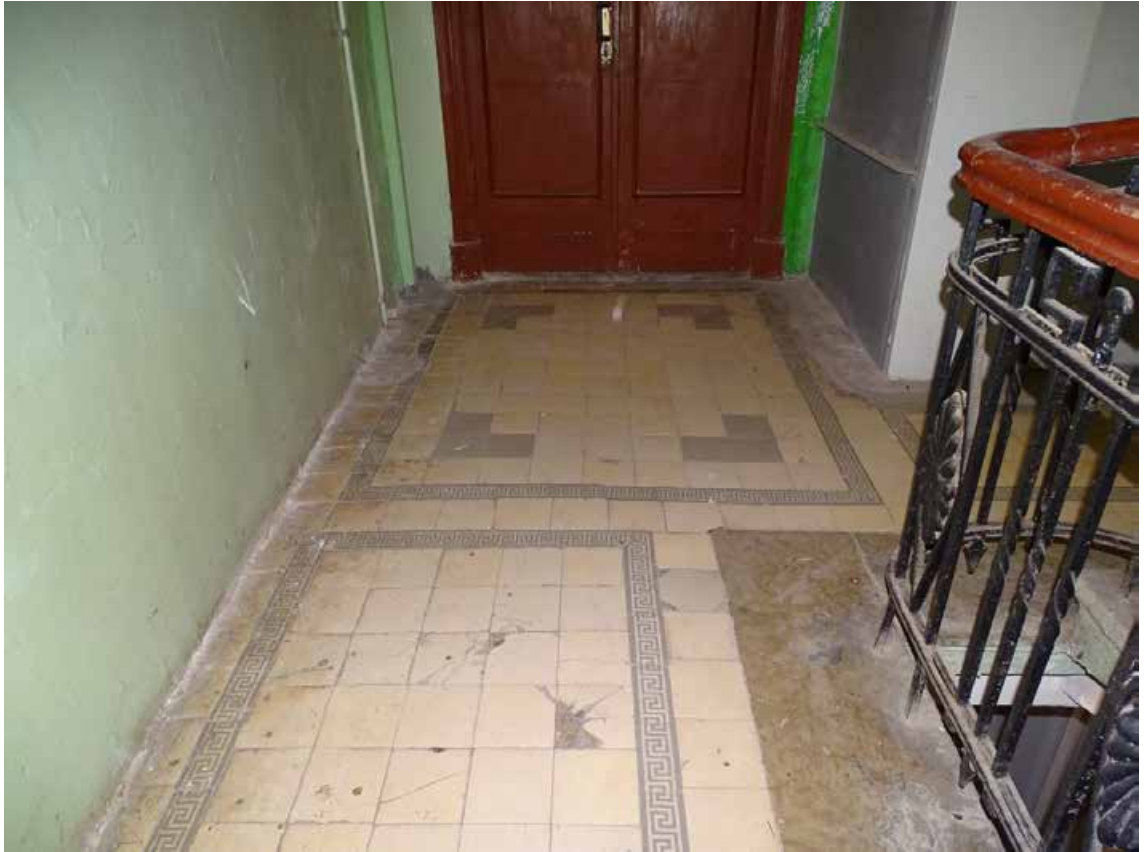
Фото 288. ЛК-1. Площадка 2-го этажа. Покрытие пола. Съемка 19.04.2021 г. Трушковский В.Э.
