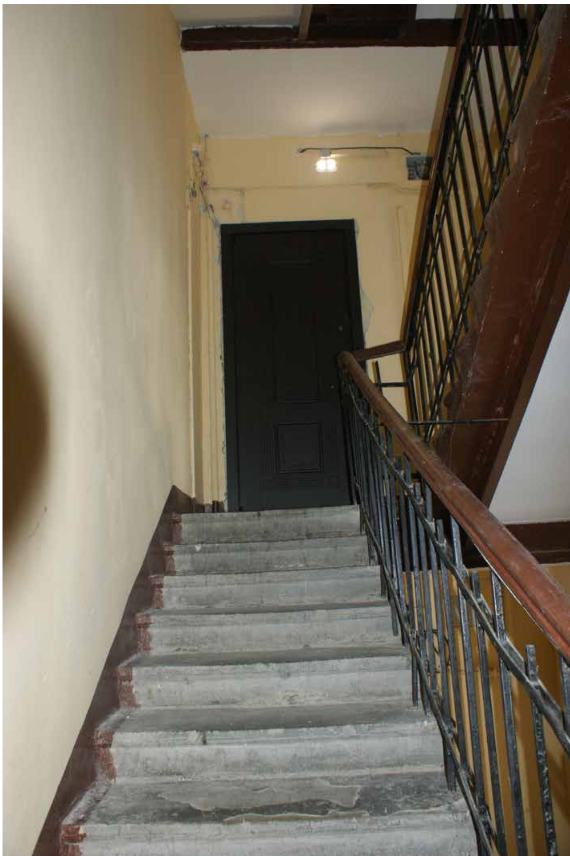
Фото 532. ЛК-9. Вид на площадку 5-го этажа. Съемка 19.04.2021 г. Трушковский В.Э.
