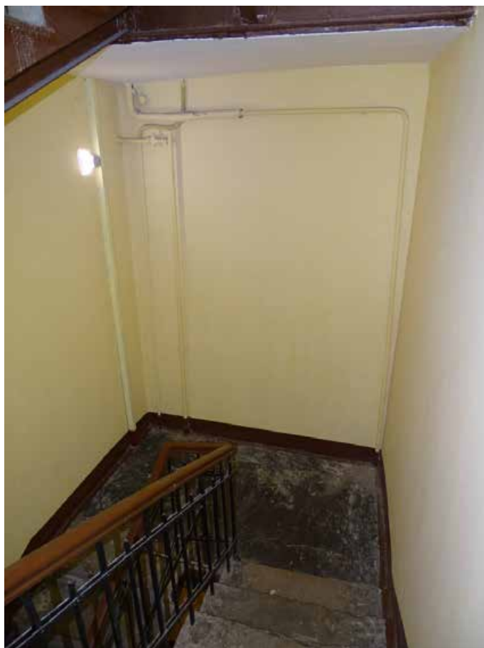
Фото 537. ЛК-9. Вид на площадку между 6-м и 7-м этажом. Съемка 19.04.2021 г. Трушковский В.Э.
