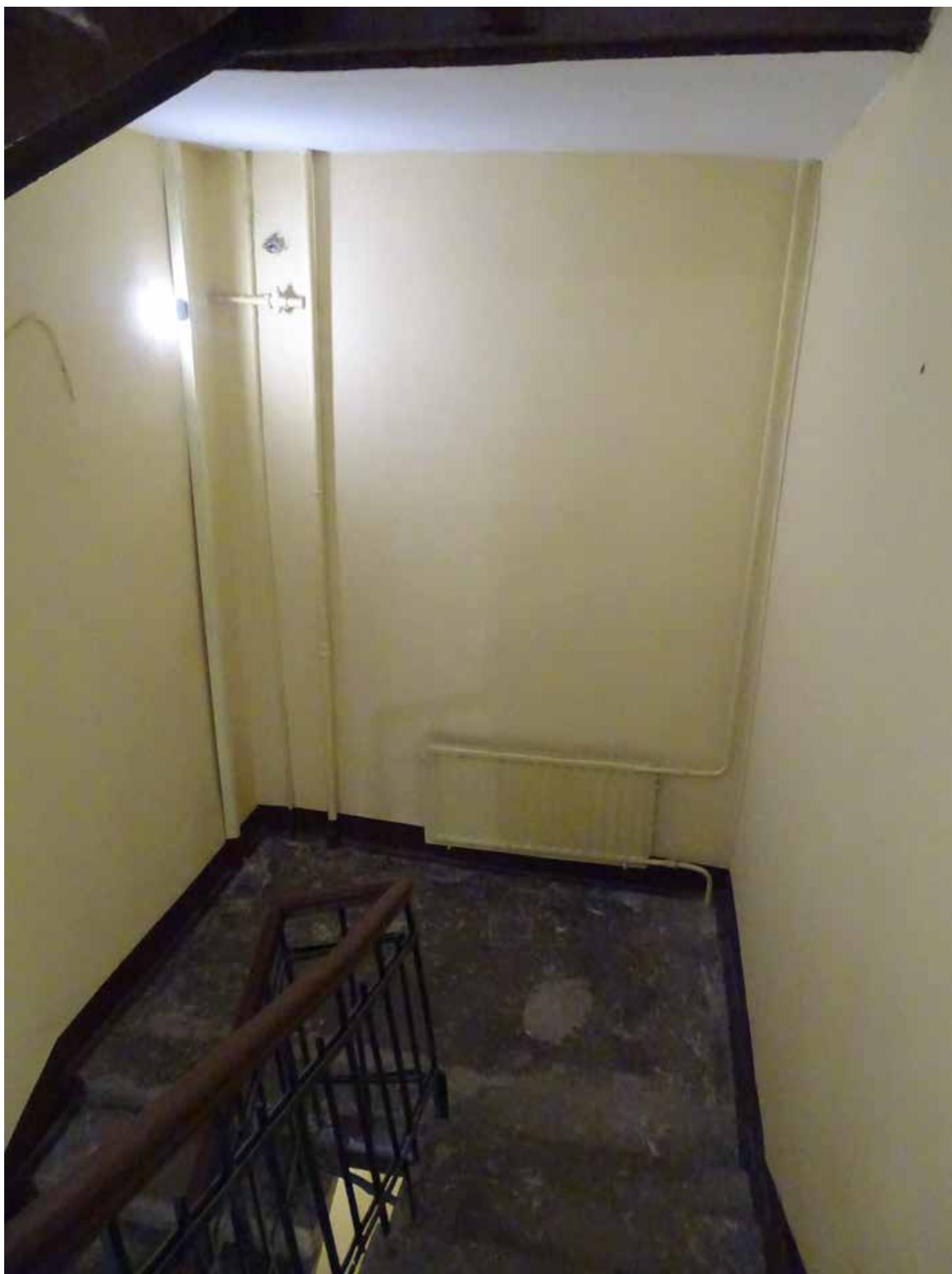
Фото 534. ЛК-9. Вид на площадку между 5-м и 6-м этажом. Съемка 19.04.2021 г. Трушковский В.Э.
