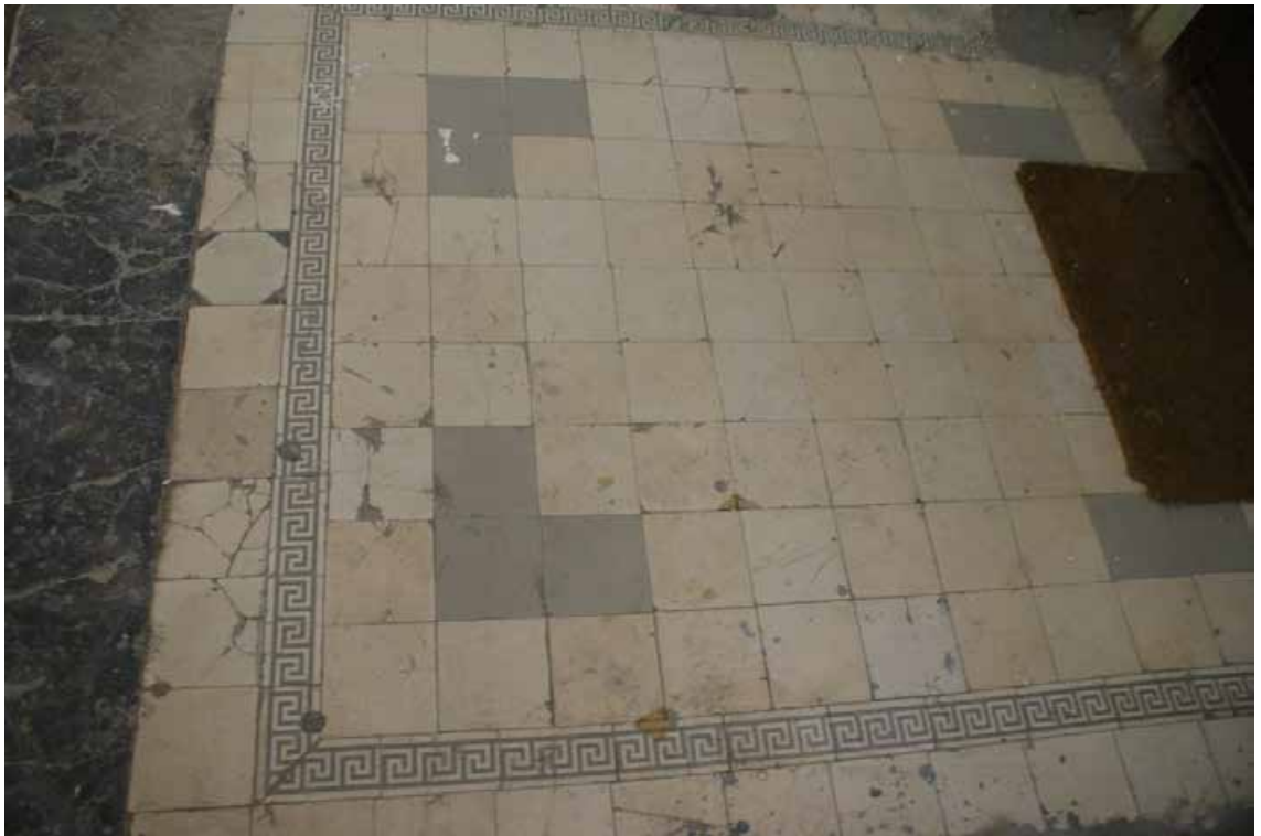
Фото 308. ЛК-1. Площадка 6-го этажа. Съемка 19.04.2021 г. Трушковский В.Э.
