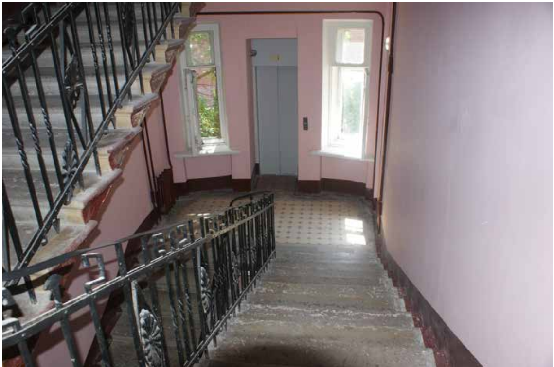
Фото 506. ЛК-8. Вид на площадку между 4-м и 5-м этажом. Съемка 19.04.2021 г. Трушковский В.Э.
