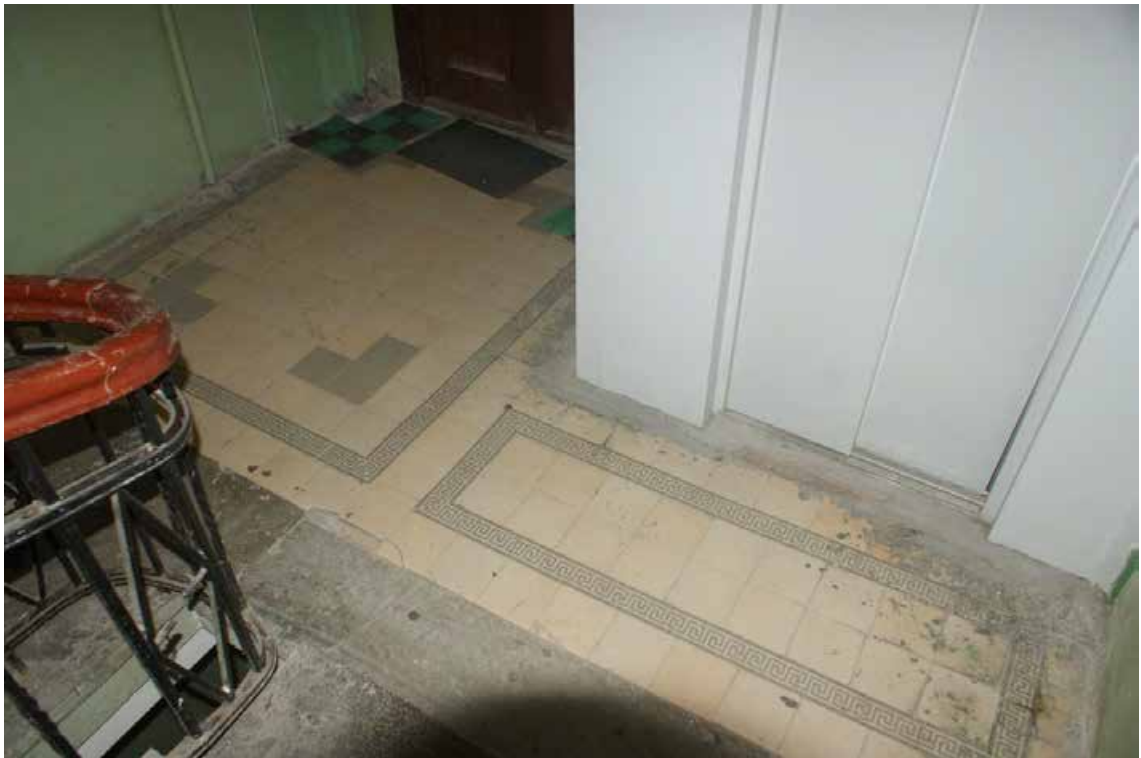
Фото 300. ЛК-1. Площадка 4-го этажа. Покрытие пола. Съемка 19.04.2021 г. Трушковский В.Э.
