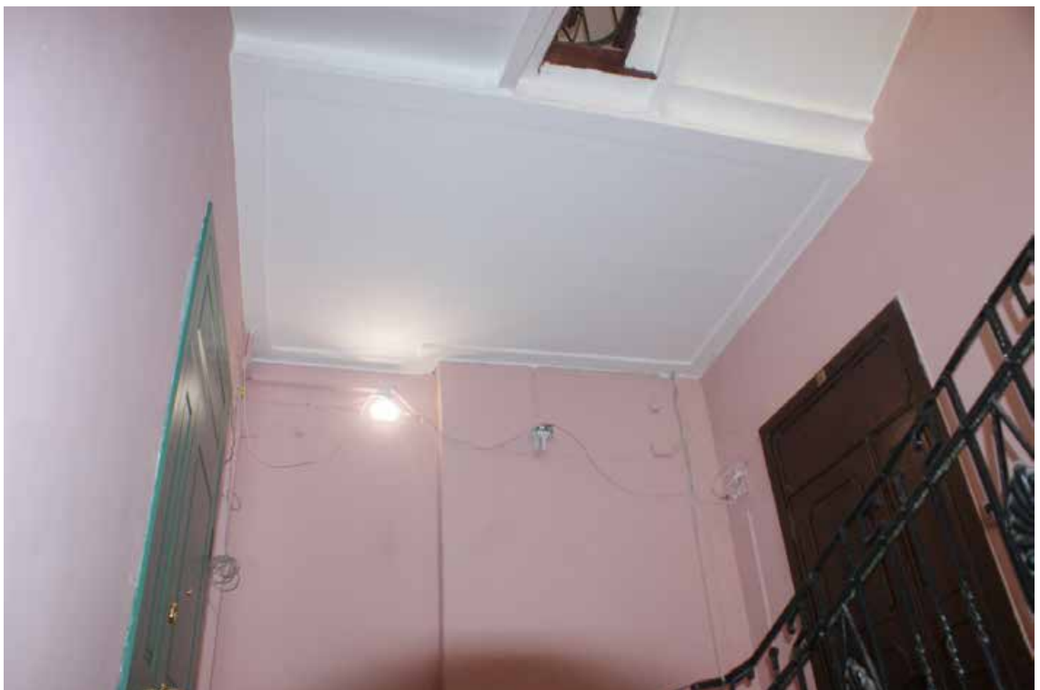
Фото 501. ЛК-8. Площадка 3-го этажа. Съемка 19.04.2021 г. Трушковский В.Э.
