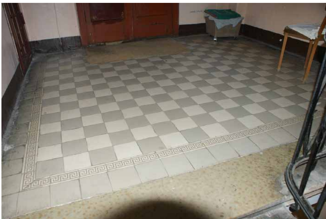
Фото 386. ЛК-3. Площадка 6-го этажа. Покрытие пола. Съемка 19.04.2021 г. Трушковский В.Э.
