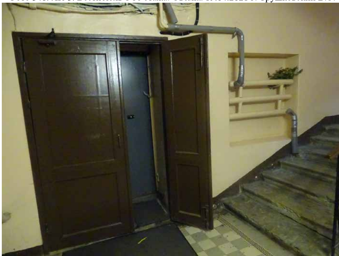
Фото 349. ЛК-3. Вестибюль 1-го этажа. Съемка 19.04.2021 г. Трушковский В.Э.
