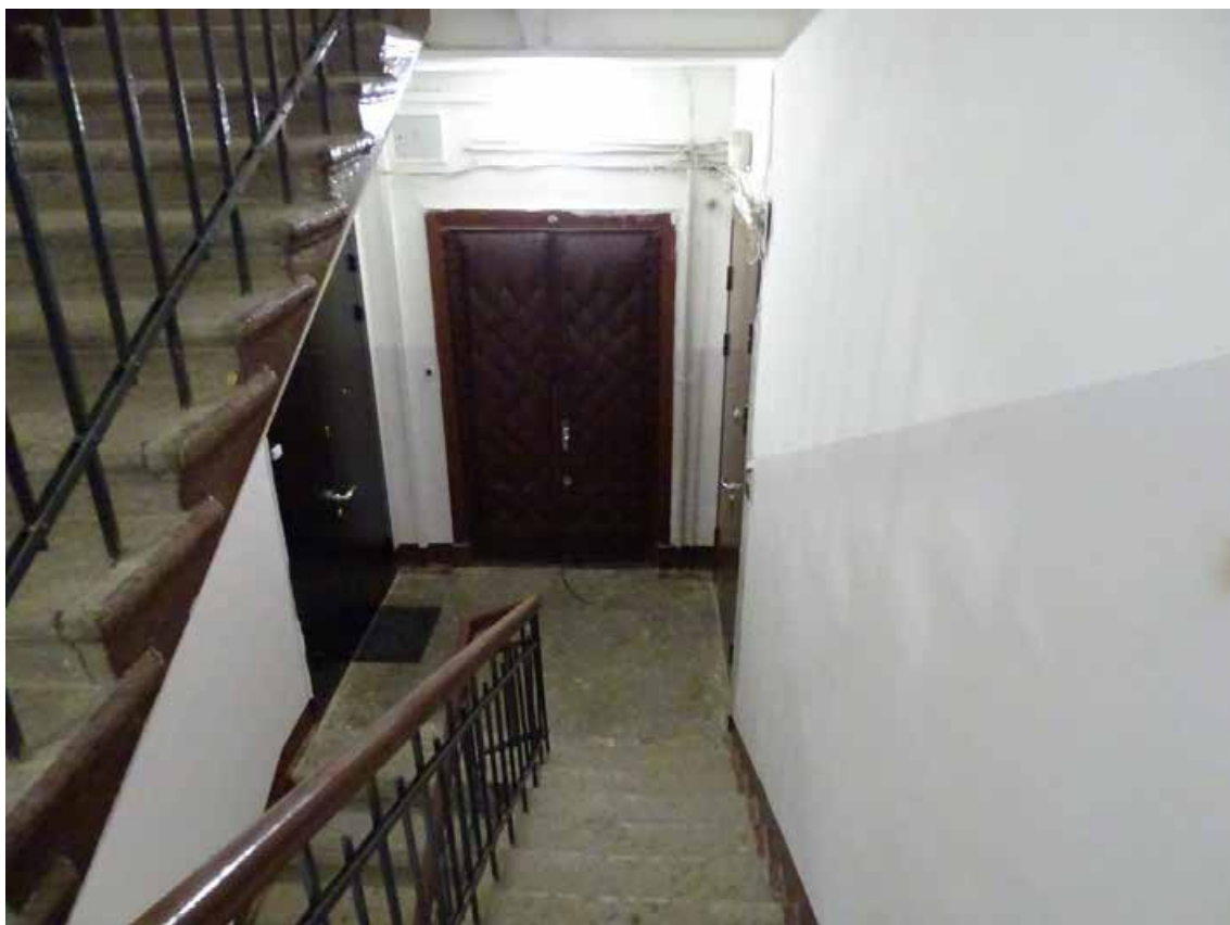
Фото 332. ЛК-2. Вид на площадку 5-го этажа. Съемка 19.04.2021 г. Трушковский В.Э.
