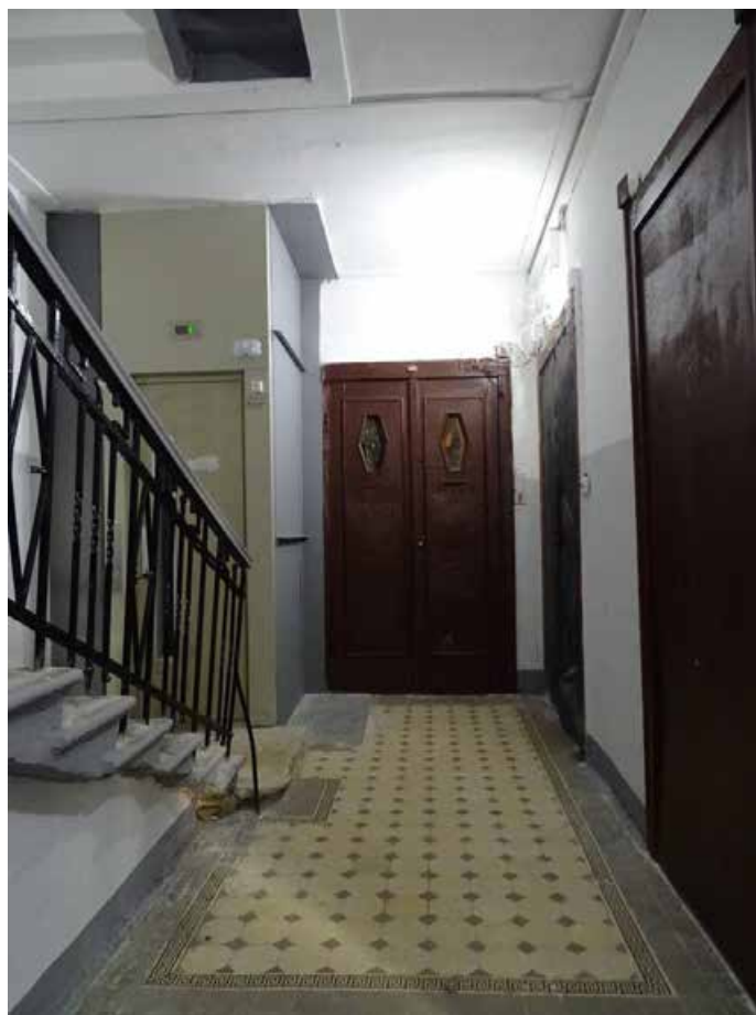
Фото 440. ЛК-6. Площадка 1-го этажа. Съемка 19.04.2021 г. Трушковский В.Э.
