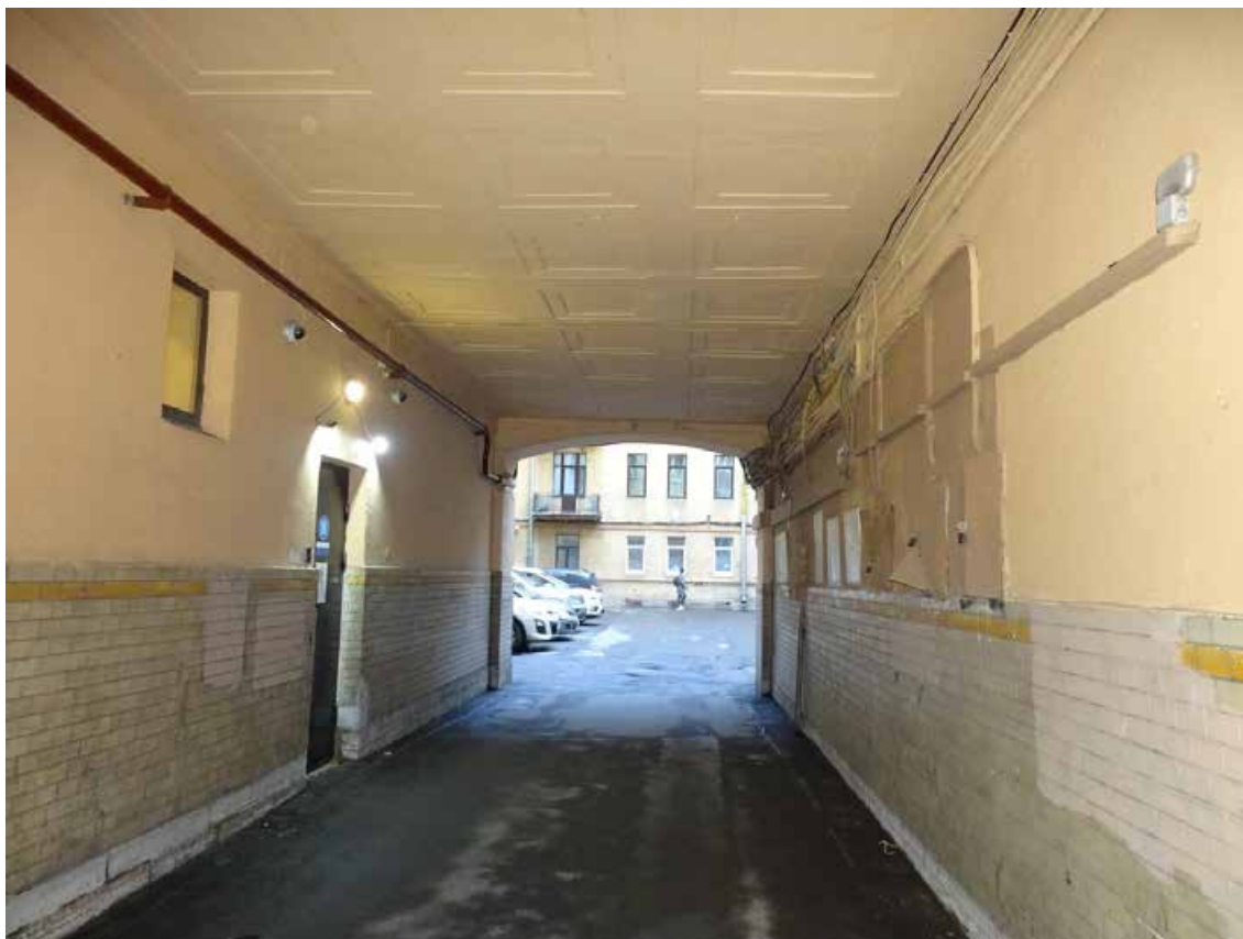
Фото 22. Здание по адресу: г. Санкт-Петербург, Большая Монетная ул., дом 29, литера А. Оформление воротного проезда. Съемка 19.04.2021 г. Трушковский В.Э.
