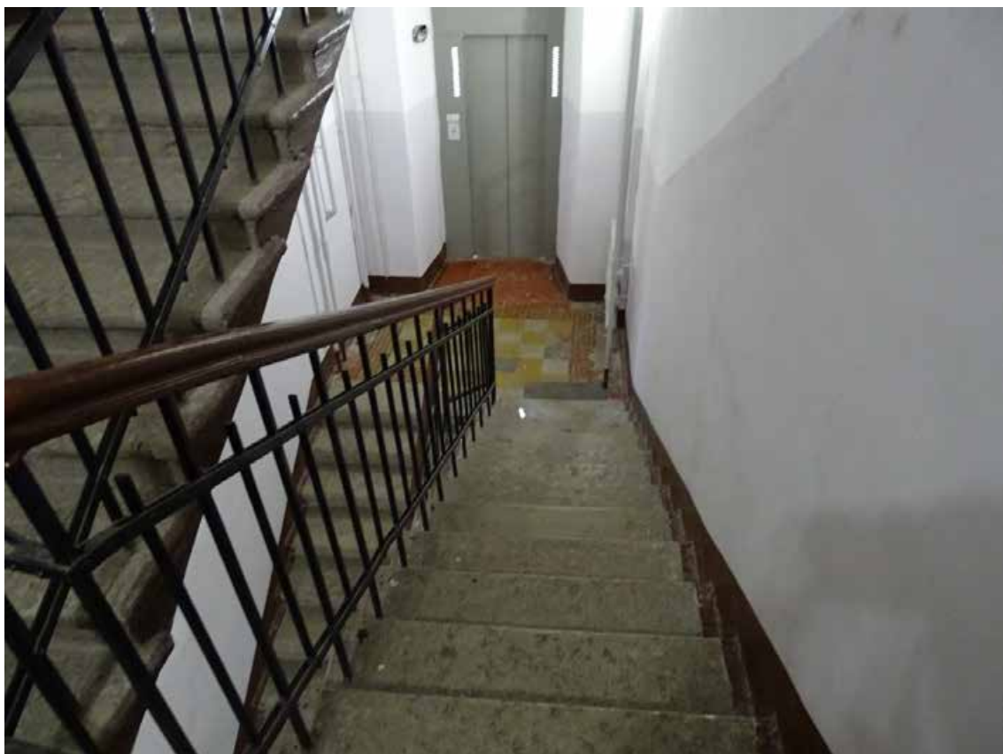
Фото 335. ЛК-2. Вид на площадку между 5-м и 6-м этажом. Съемка 19.04.2021 г. Трушковский В.Э.
