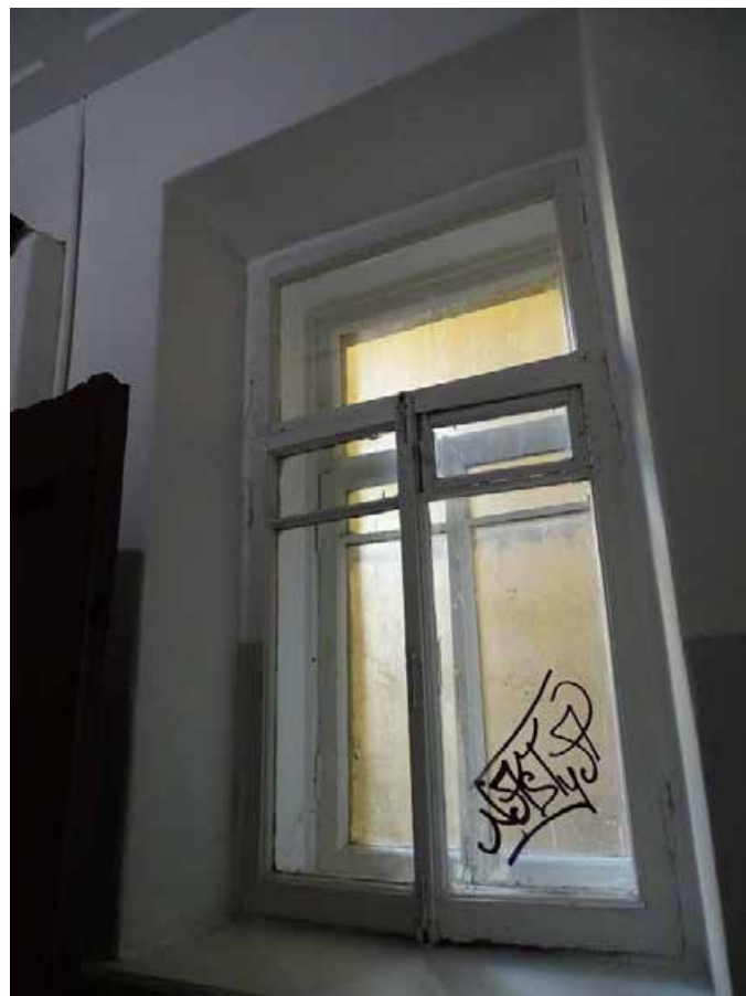
Фото 433. ЛК-6. Вестибюль 1-го этажа. Оформление окна. Съемка 19.04.2021 г. Трушковский В.Э.
