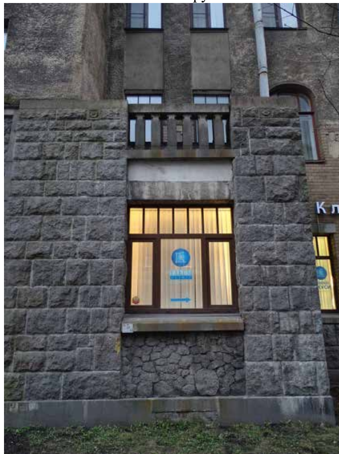
Фото 18. Здание по адресу: г. Санкт-Петербург, Большая Монетная ул., дом 29, литера А. Фрагмент фасада по Большой Монетной ул. Съемка 19.04.2021 г. Трушковский В.Э.
