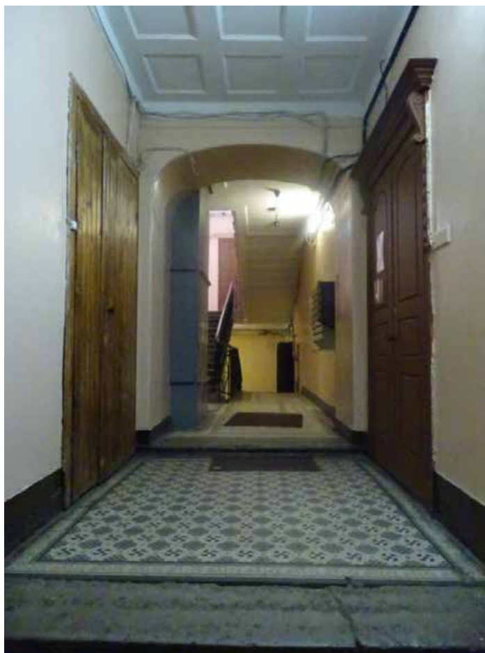
Фото 346. ЛК-3. Вестибюль 1-го этажа. Вестибюль 1-го этажа. Съемка 19.04.2021 г. Трушковский В.Э.
