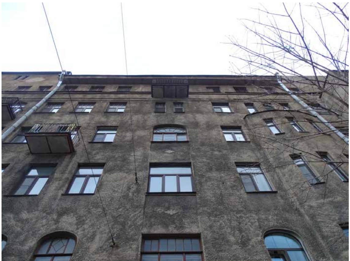
Фото 10. Здание по адресу: г. Санкт-Петербург, Большая Монетная ул., дом 29, литера А. Фрагмент фасада по Большой Монетной ул. Съемка 19.04.2021 г. Трушковский В.Э.
