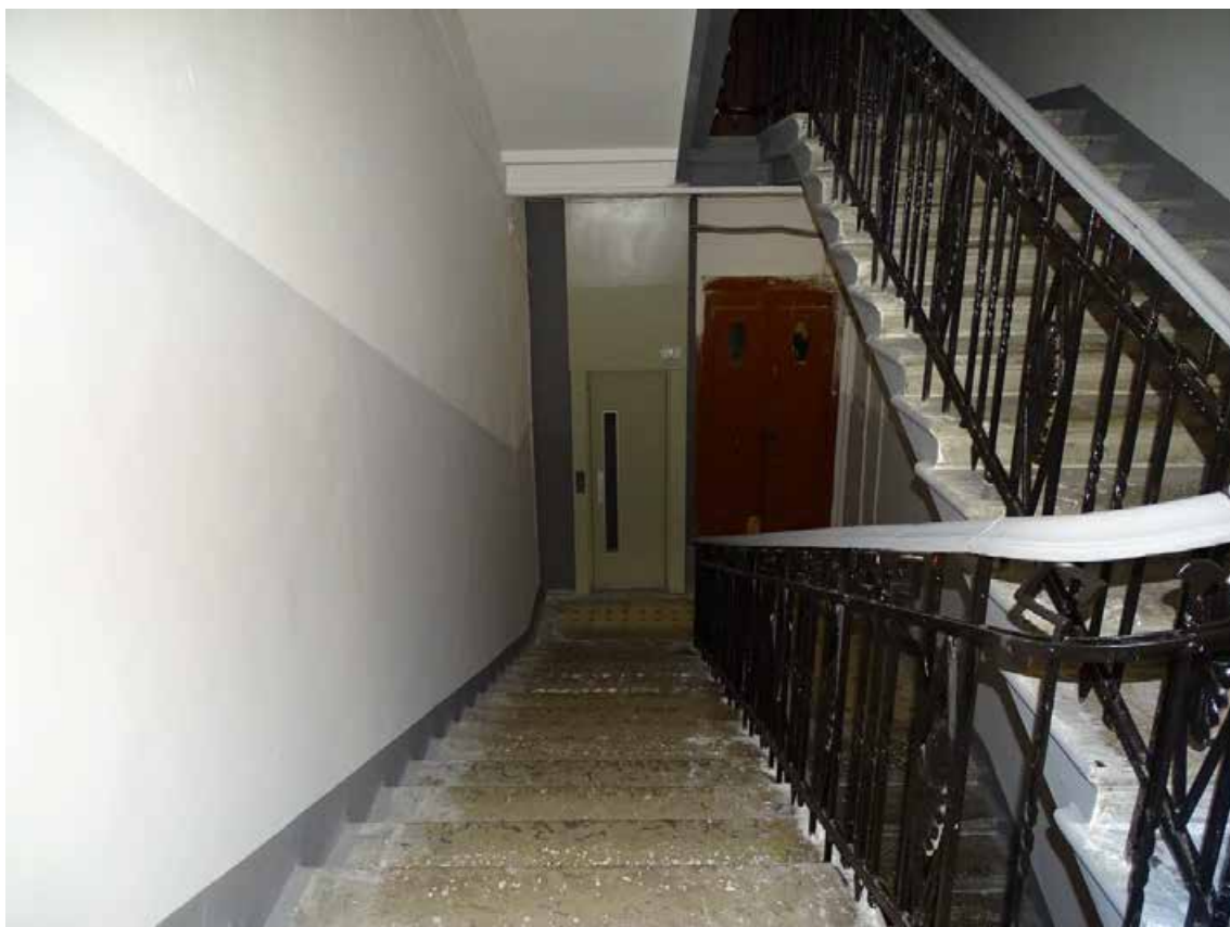
Фото 450. ЛК-6. Вид на площадку 2-го этажа. Съемка 19.04.2021 г. Трушковский В.Э.
