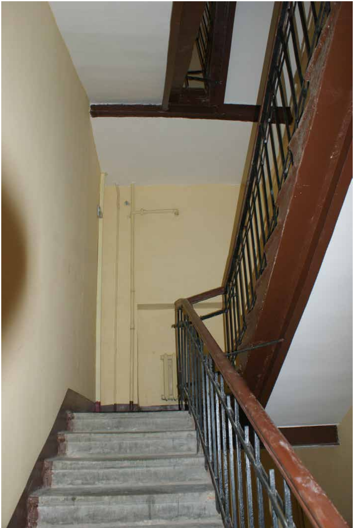
Фото 527. ЛК-9. Вид на площадку между 3-м и 4-м этажом. Съемка 19.04.2021 г. Трушковский В.Э.
