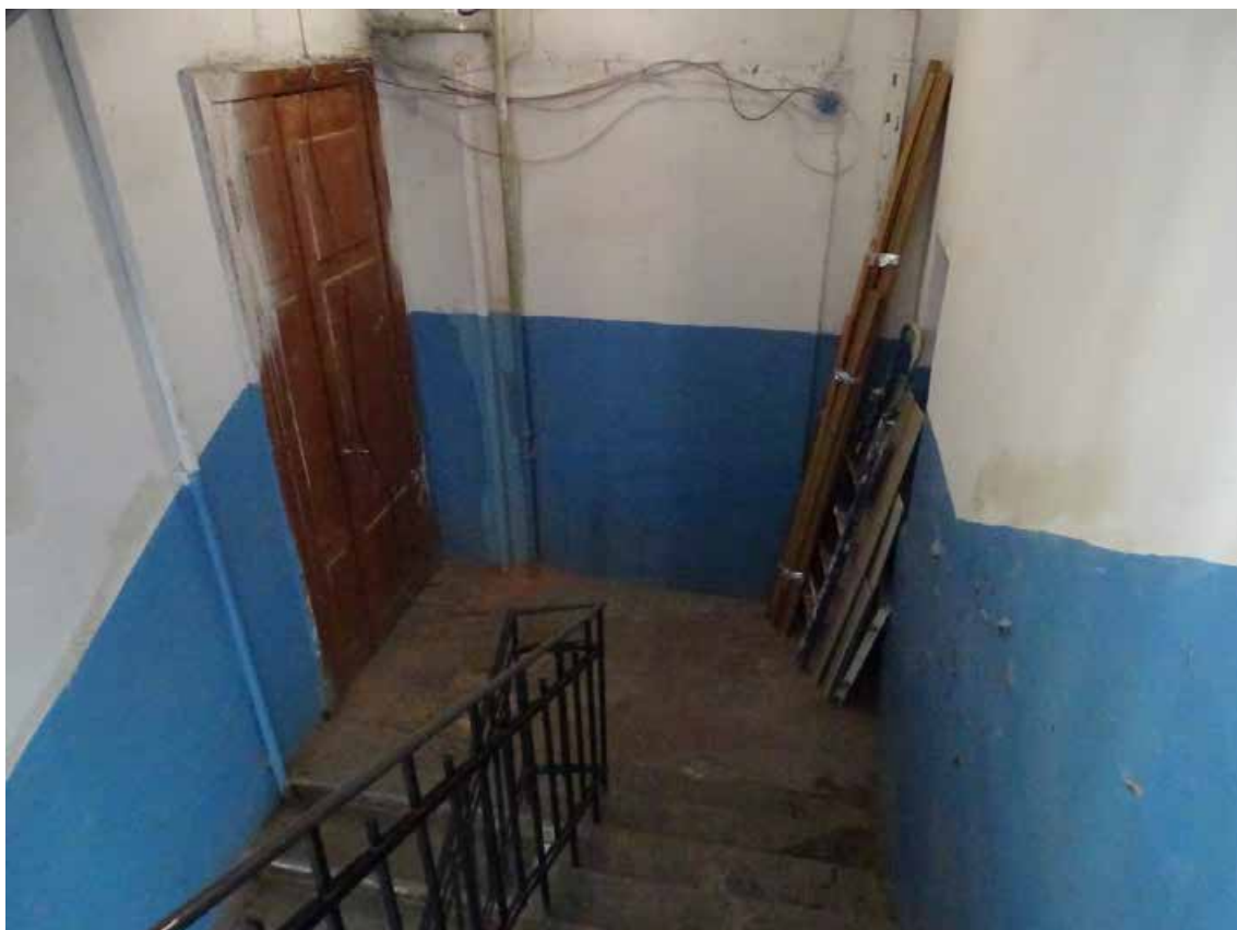
Фото 424. ЛК-5. Площадка 6-го этажа. Съемка 19.04.2021 г. Трушковский В.Э.
