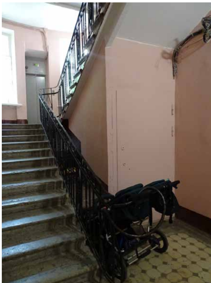
Фото 488. ЛК-8. Вестибюль 1-го этажа. Съемка 19.04.2021 г. Трушковский В.Э.
