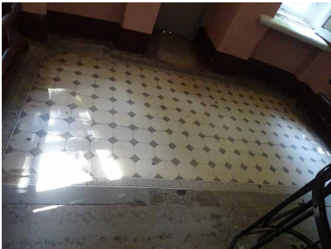
Фото 493. ЛК-8. Площадка между 1-м и 2-м этажом. Покрытие пола. Съемка 19.04.2021 г. Трушковский В.Э.
