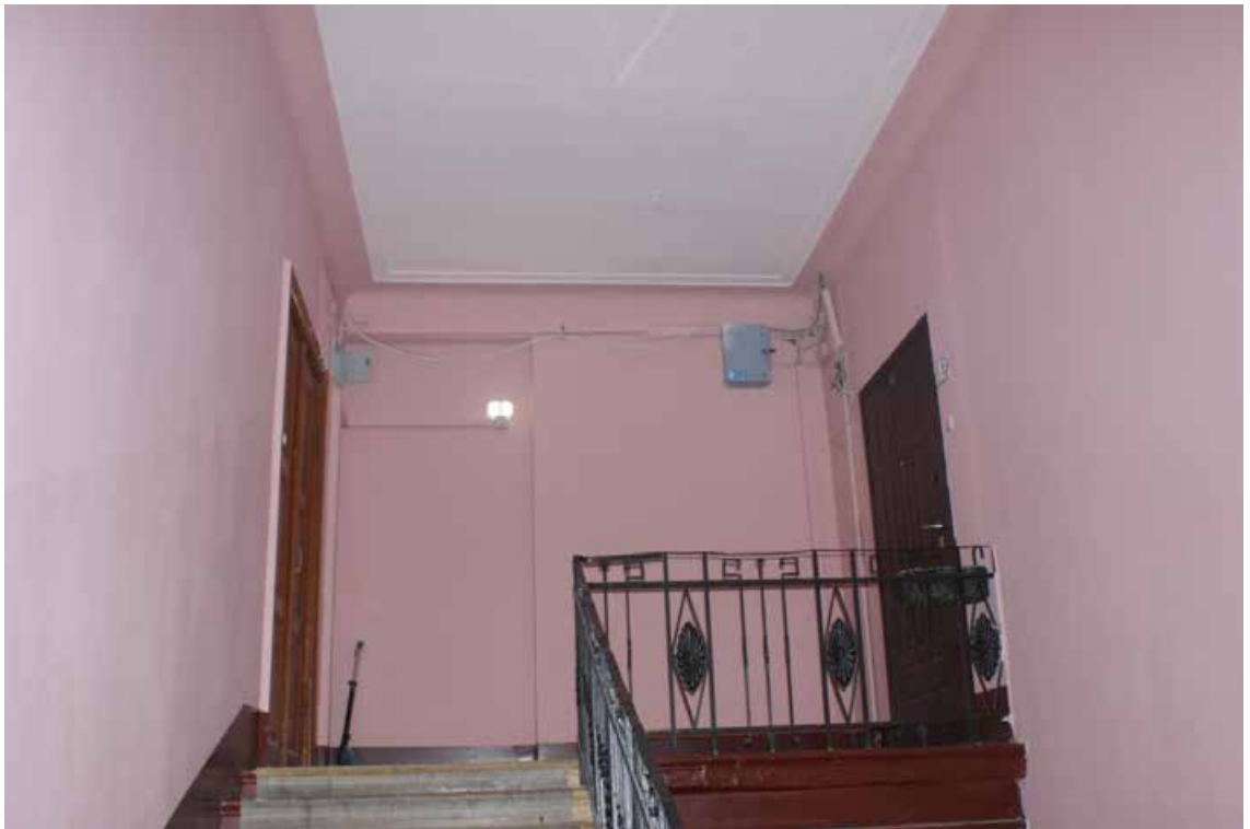
Фото 512. ЛК-8. Вид на площадку 6-го этажа. Съемка 19.04.2021 г. Трушковский В.Э.
