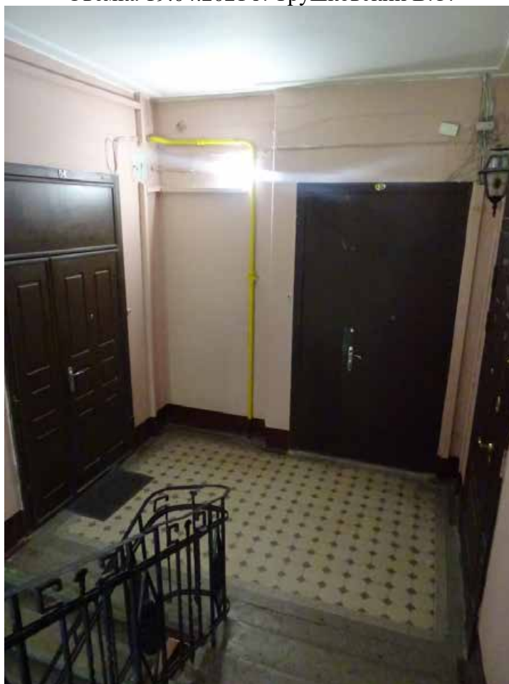
Фото 495. ЛК-8. Вид на площадку 2-го этажа. Съемка 19.04.2021 г. Трушковский В.Э.
