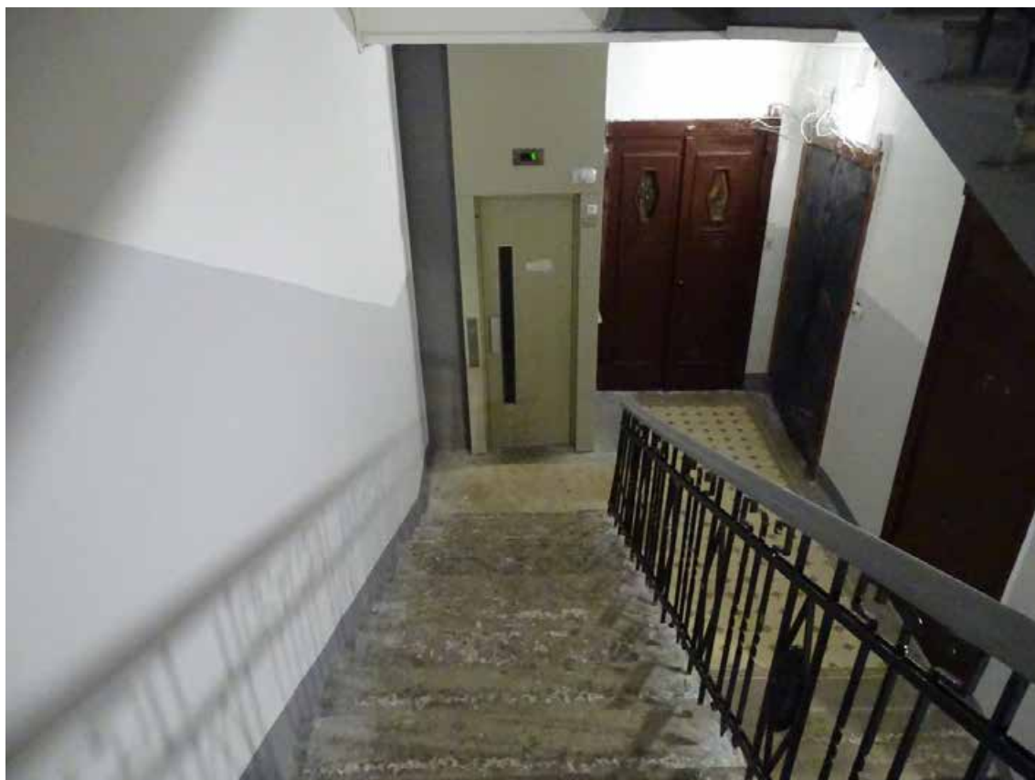
Фото 441. ЛК-6. Площадка 1-го этажа. Съемка 19.04.2021 г. Трушковский В.Э.
