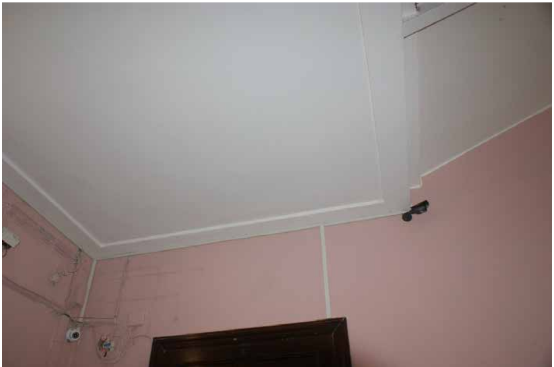
Фото 505. ЛК-8. Площадка 4-го этажа. Съемка 19.04.2021 г. Трушковский В.Э.
