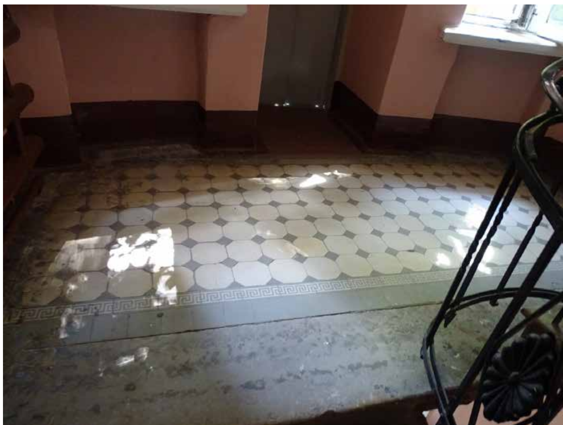
Фото 499. ЛК-8. Площадка между 2-м и 3-м этажом. Покрытие пола. Съемка 19.04.2021 г. Трушковский В.Э.
