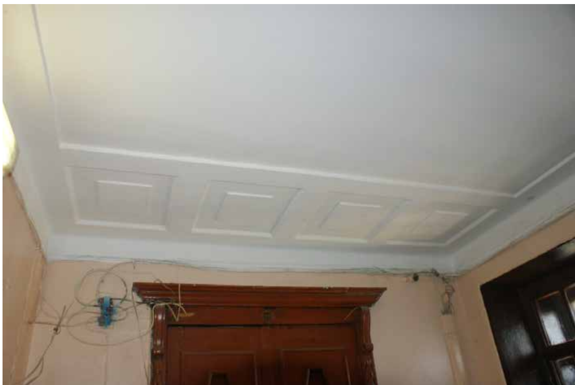
Фото 383. ЛК-3. Площадка 6-го этажа. Съемка 19.04.2021 г. Трушковский В.Э.
