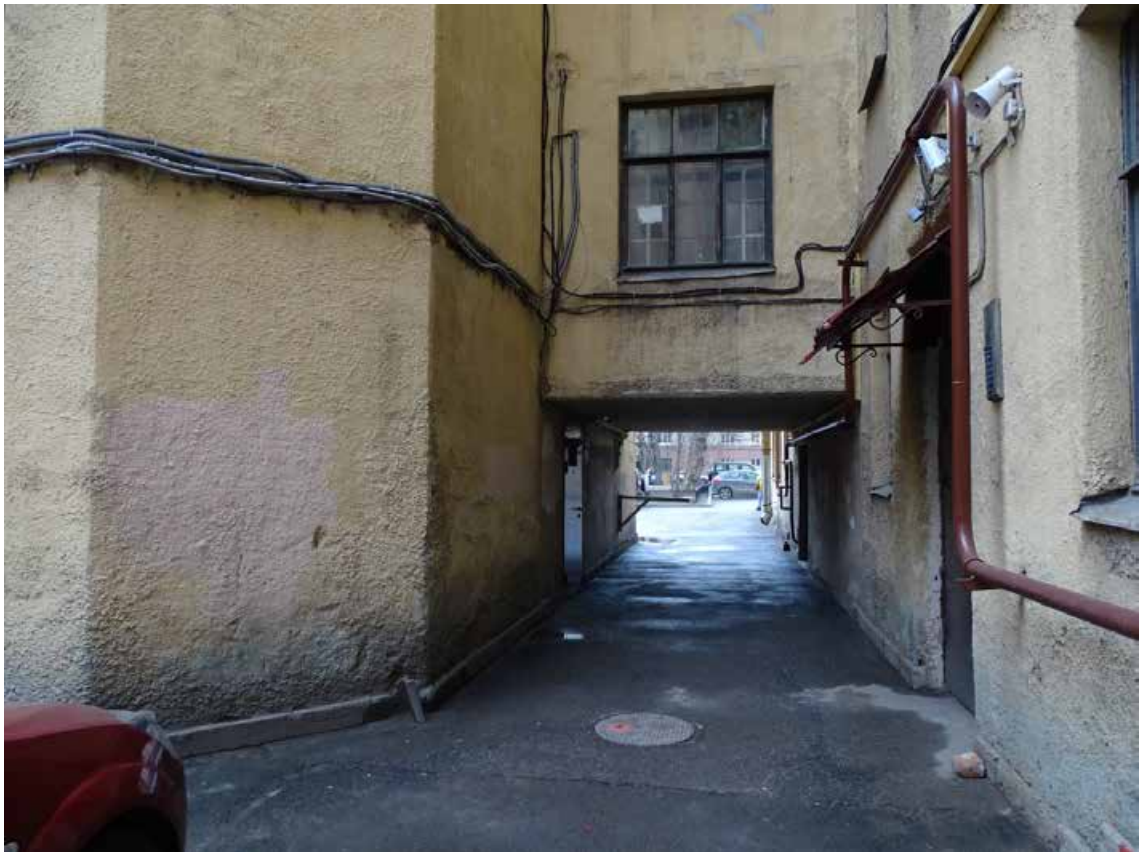
Фото 33. Здание по адресу: г. Санкт-Петербург, Большая Монетная ул., дом 29, литера А. Фрагмент восточного дворового фасада. Воротный проезд. Съемка 19.04.2021 г. Трушковский В.Э.
