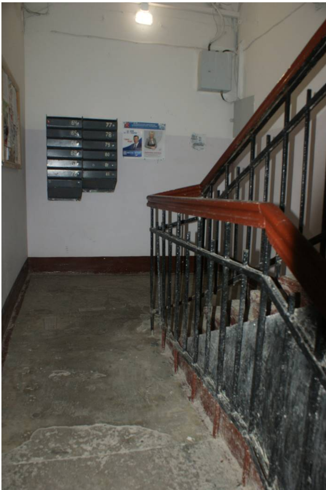
Фото 314. ЛК-2. Площадка 1-го этажа. Съемка 19.04.2021 г. Трушковский В.Э.
