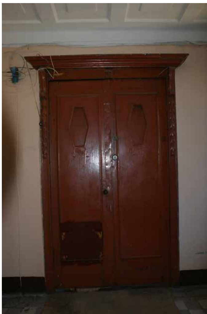
Фото 384. ЛК-3. 6 этаж. Дверной проем. Съемка 19.04.2021 г. Трушковский В.Э.
