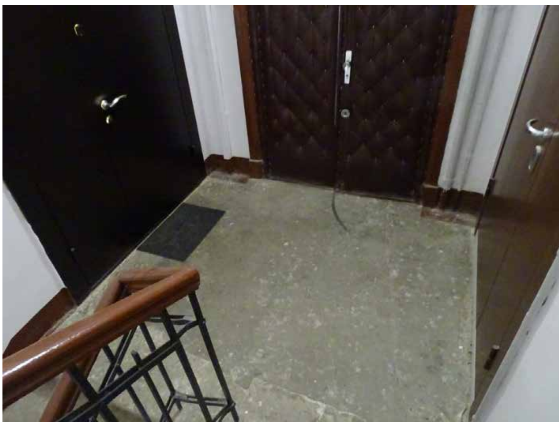
Фото 333. ЛК-2. Площадка 5-го этажа. Съемка 19.04.2021 г. Трушковский В.Э.
