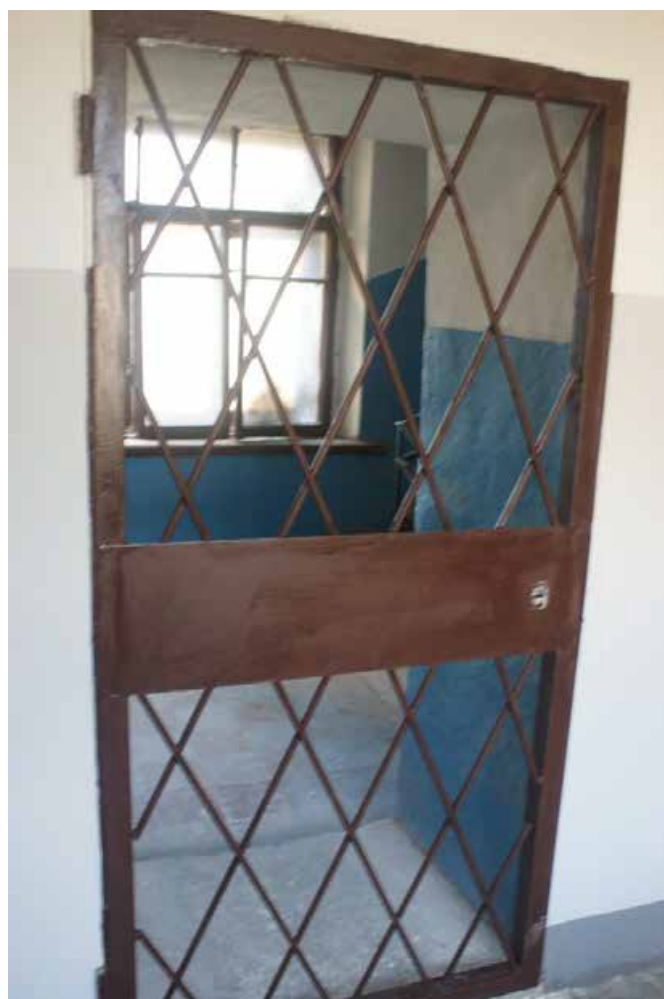
Фото 480. ЛК-6. Вид на площадку между 6-м и чердачным этажом. Дверь на соседнюю лестницу. Съемка 19.04.2021 г. Трушковский В.Э.
