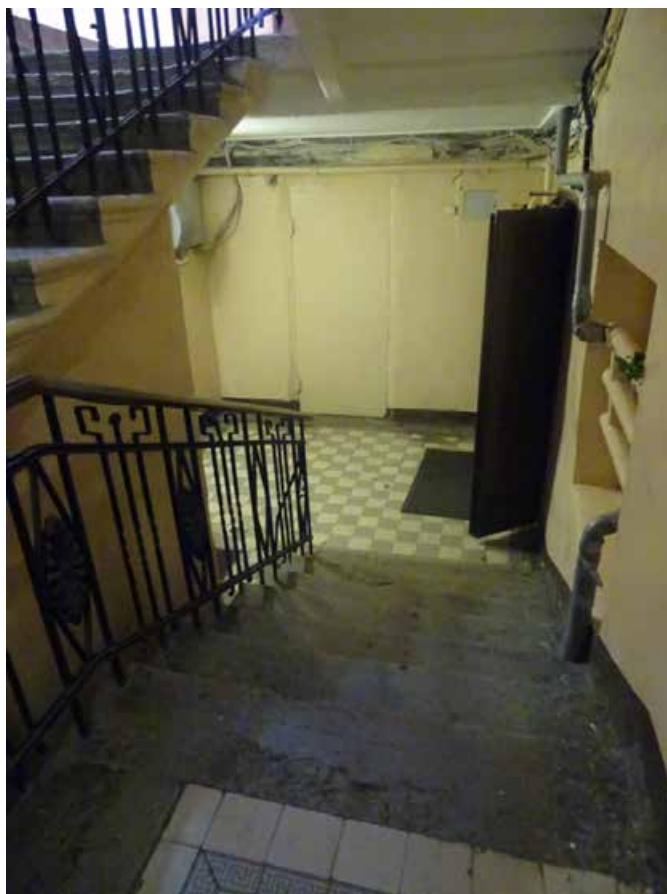
Фото 352. ЛК-3. Вестибюль 1-го этажа. Съемка 19.04.2021 г. Трушковский В.Э.
