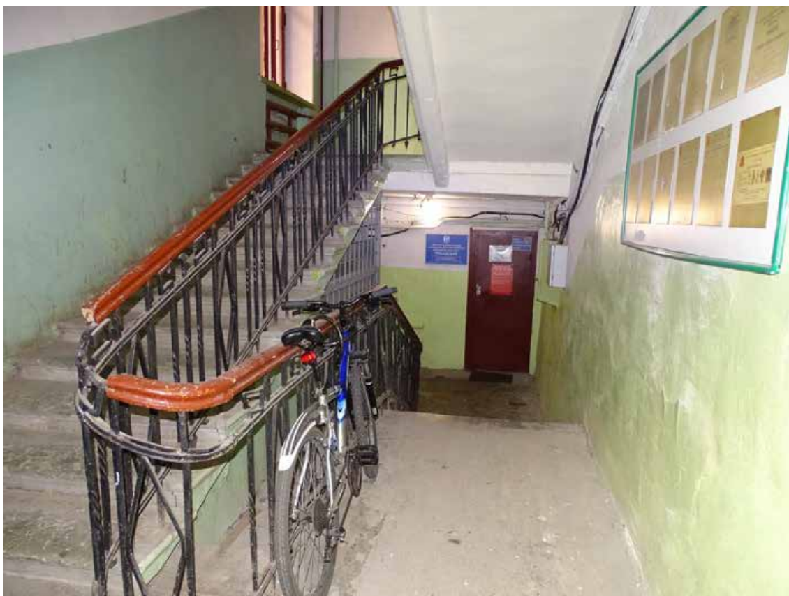
Фото 278. ЛК-1. Площадка 1-го этажа. Пространство под лестницей. Съемка 19.04.2021 г. Трушковский В.Э.
