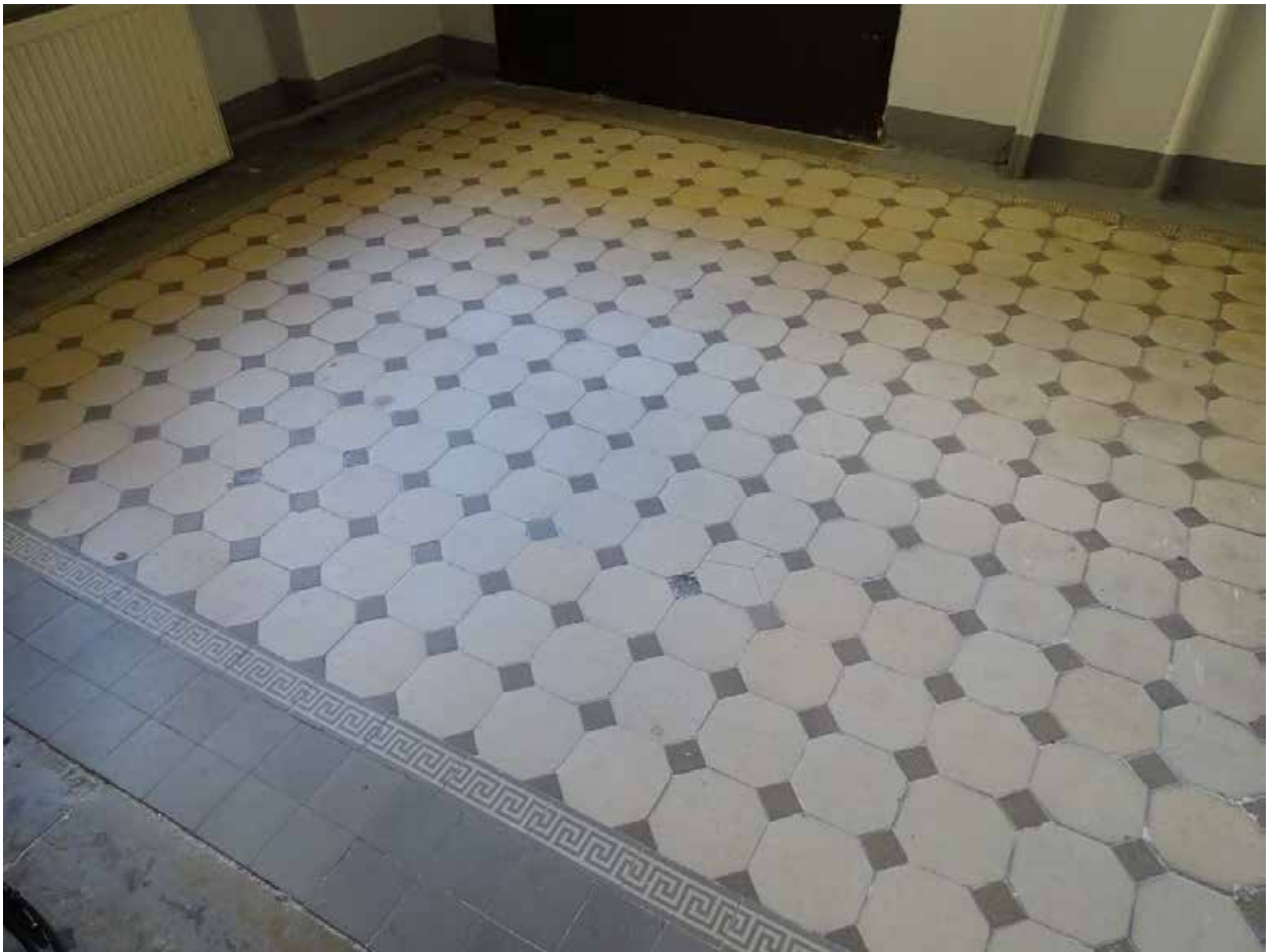
Фото 460. ЛК-6. Площадка между 3-м и 4-м этажом. Покрытие пола. Съемка 19.04.2021 г. Трушковский В.Э.
