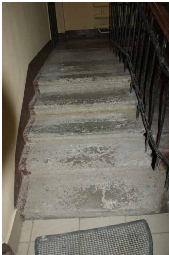
Фото 516. ЛК-9. Вестибюль 1-го этажа. Съемка 19.04.2021 г. Трушковский В.Э.
