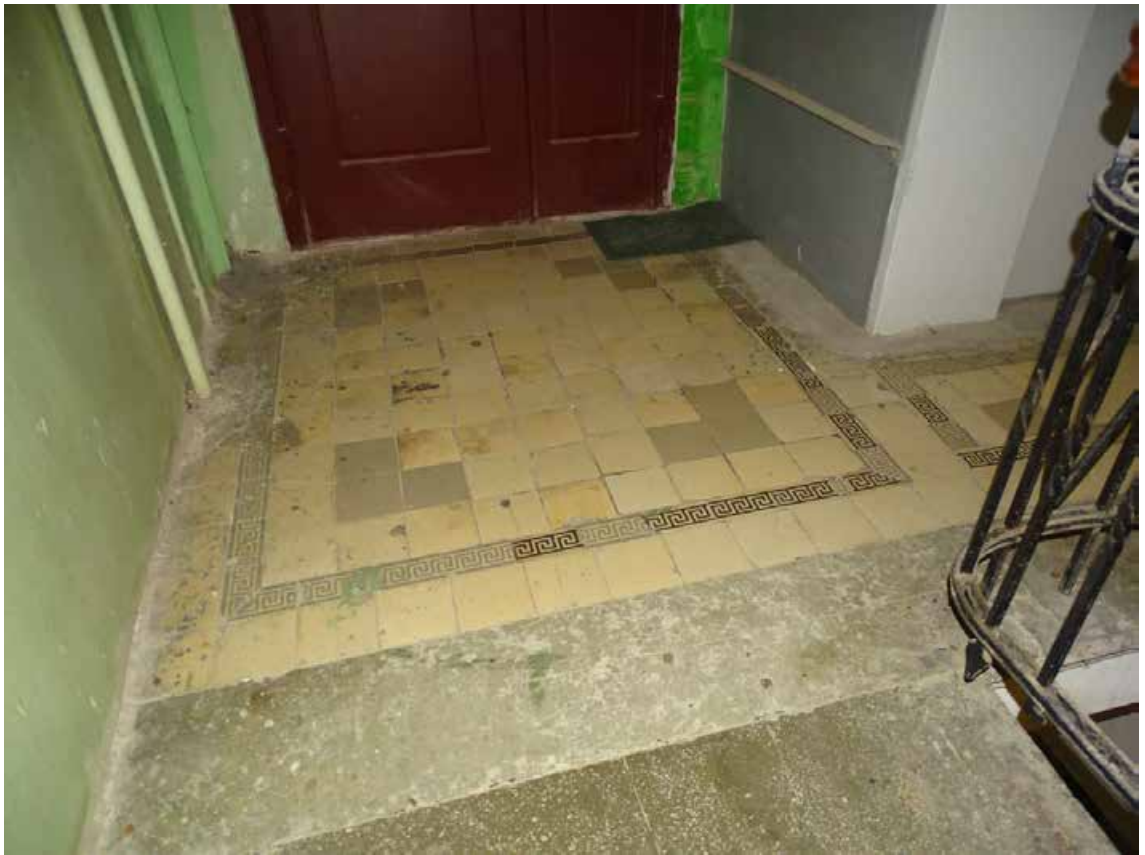
Фото 296. ЛК-1. Площадка 3-го этажа. Покрытие пола. Съемка 19.04.2021 г. Трушковский В.Э.
