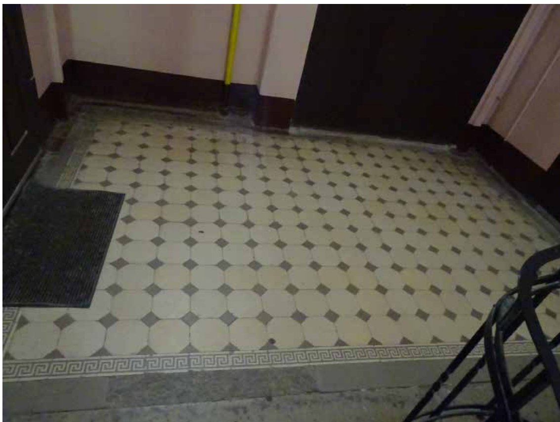
Фото 496. ЛК-8. Площадка 2-го этажа. Покрытие пола. Съемка 19.04.2021 г. Трушковский В.Э.
