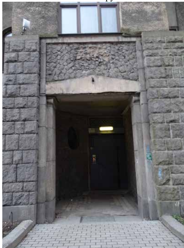
Фото 16. Здание по адресу: г. Санкт-Петербург, Большая Монетная ул., дом 29, литера А. Фрагмент фасада по Большой Монетной ул. Исторический дверной проем. Съемка 19.04.2021 г. Трушковский В.Э.
