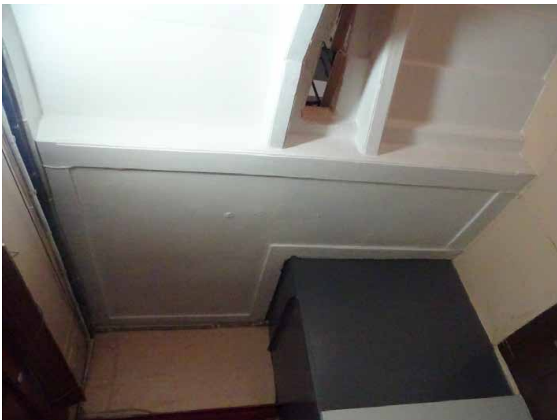
Фото 357. ЛК-3. Площадка 2-го этажа. Съемка 19.04.2021 г. Трушковский В.Э.
