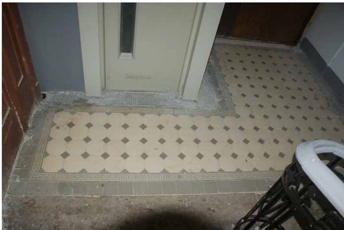
Фото 468. ЛК-6. Площадка 5-го этажа. Съемка 19.04.2021 г. Трушковский В.Э.
