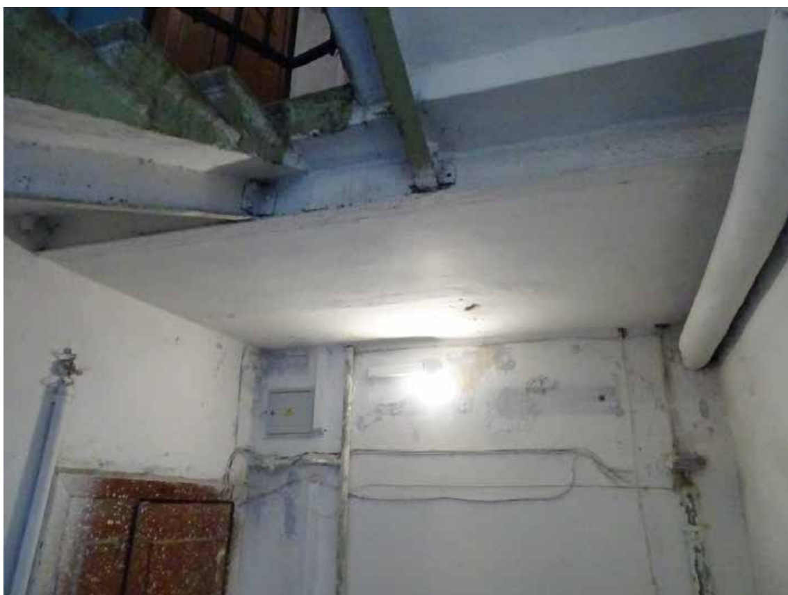
Фото 419. ЛК-5. Площадка 5-го этажа. Съемка 19.04.2021 г. Трушковский В.Э.
