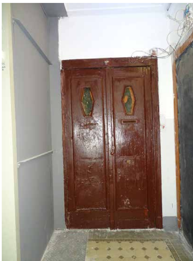
Фото 443. ЛК-6. Площадка 1-го этажа. Оформление двери. Съемка 19.04.2021 г. Трушковский В.Э.
