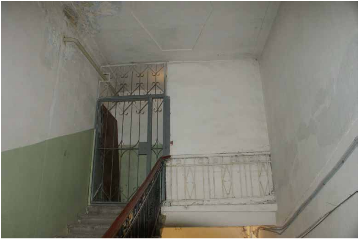
Фото 310. ЛК-1. Чердачный этаж. Съемка 19.04.2021 г. Трушковский В.Э.
