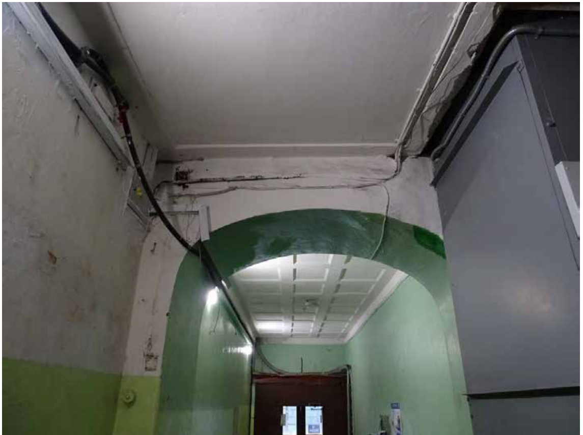
Фото 282. ЛК-1. Площадка 1-го этажа. Съемка 19.04.2021 г. Трушковский В.Э.
