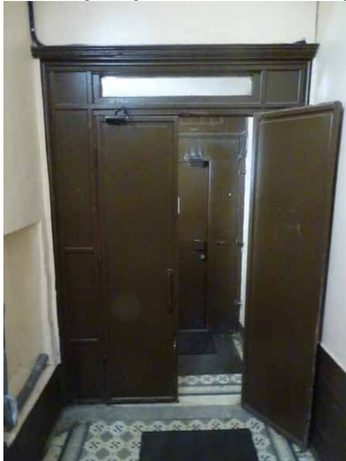
Фото 343. ЛК-3. Вестибюль 1-го этажа. Входная дверь. Съемка 19.04.2021 г. Трушковский В.Э
