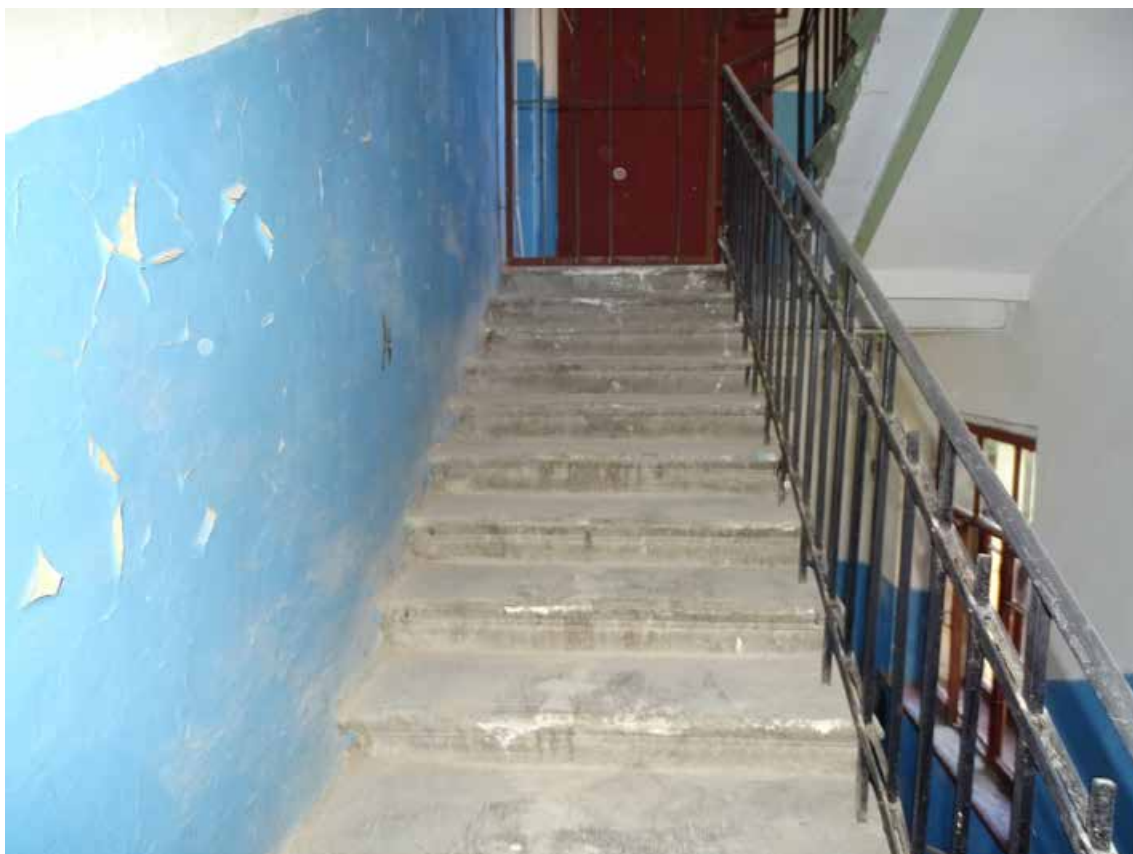
Фото 426. ЛК-5. Вид на площадку между 6-м и чердачным этажом. Съемка 19.04.2021 г. Трушковский В.Э.
