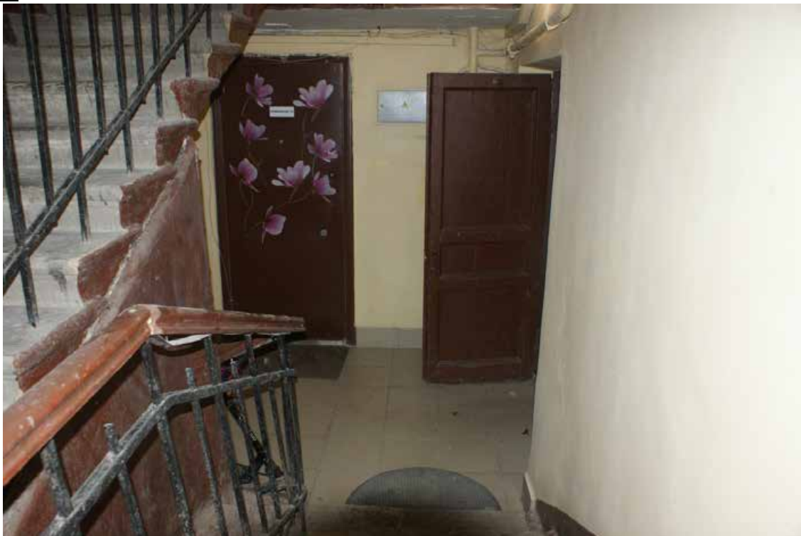
Фото 514. ЛК-9. Вестибюль 1-го этажа. Съемка 19.04.2021 г. Трушковский В.Э.
