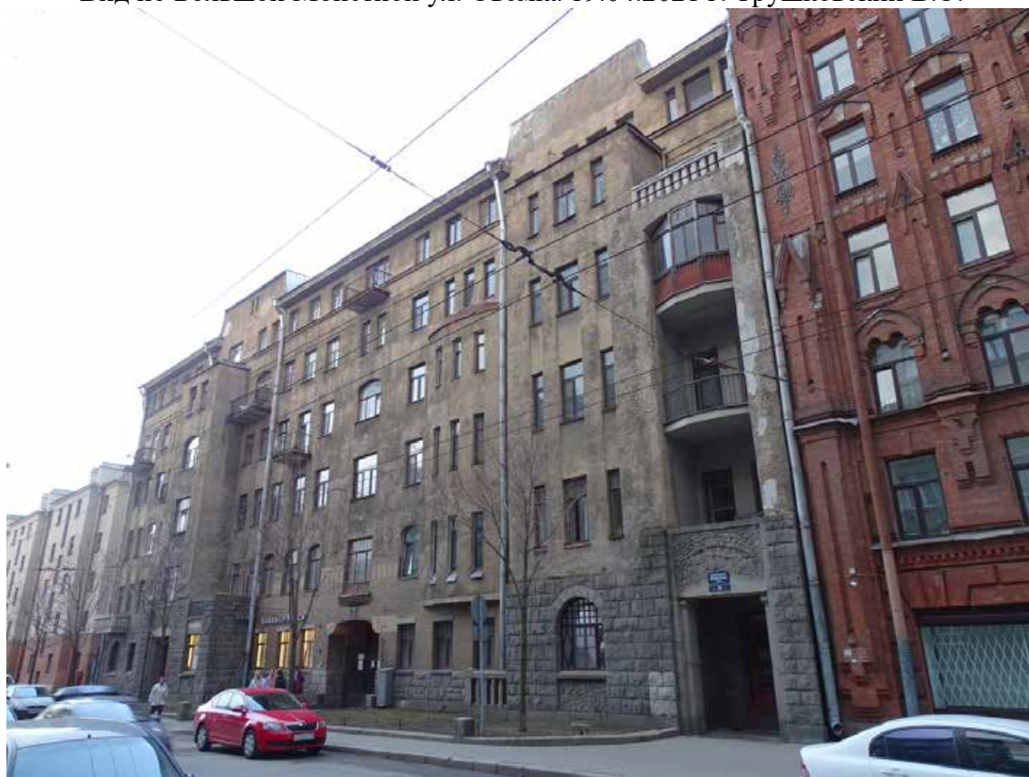
Фото 2. Здание по адресу: г. Санкт-Петербург, Большая Монетная ул., дом 29, литера А. Вид по Большой Монетной ул. Съемка 19.04.2021 г. Трушковский В.Э.
