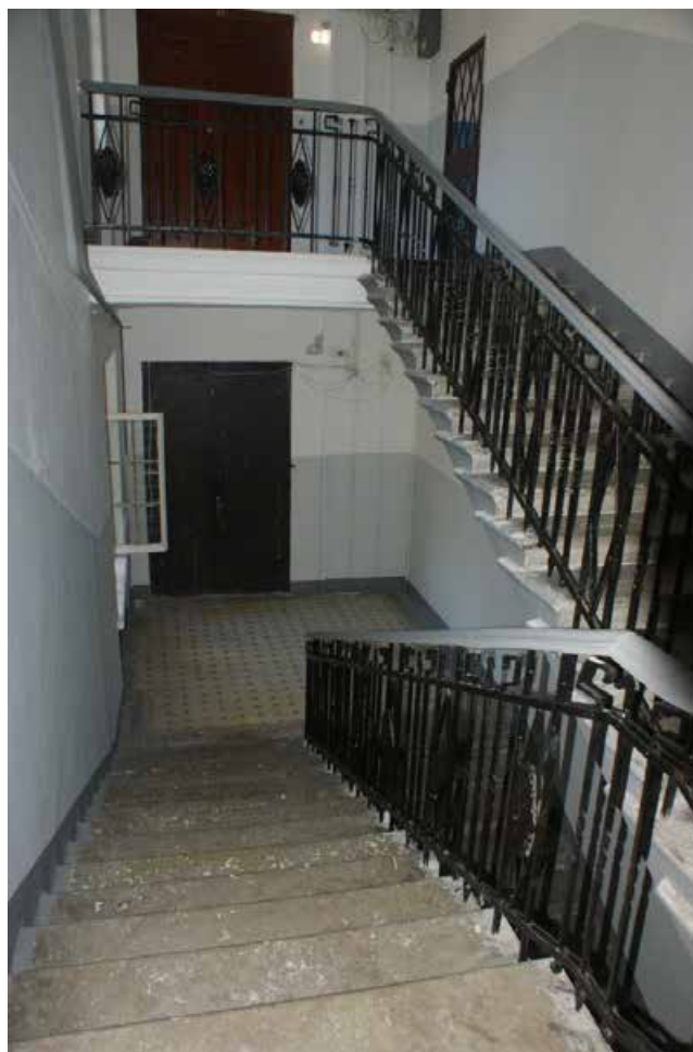
Фото 469. ЛК-6. Вид на площадку между 5-м и 6-м этажом. Съемка 19.04.2021 г. Трушковский В.Э.
