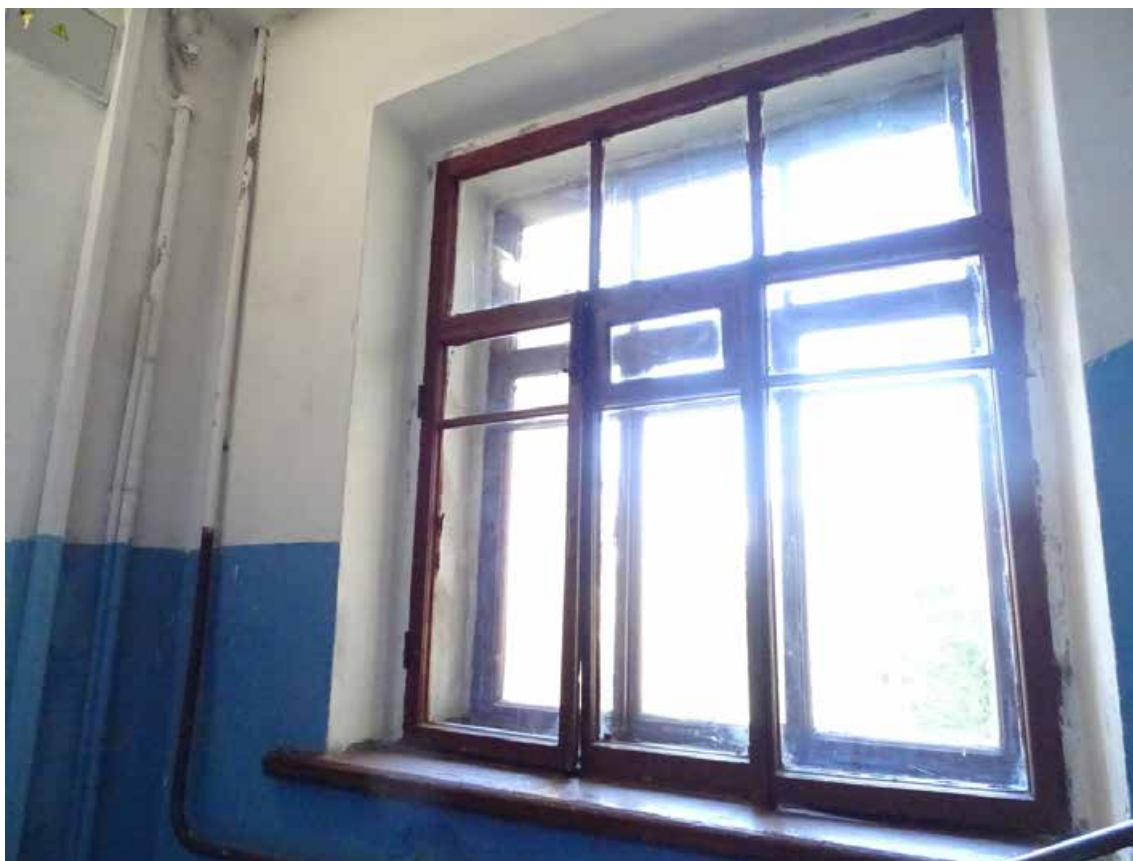
Фото 410. ЛК-5. Площадка между 3-м и 4-м этажом. Оформление окна. Съемка 19.04.2021 г. Трушковский В.Э.
