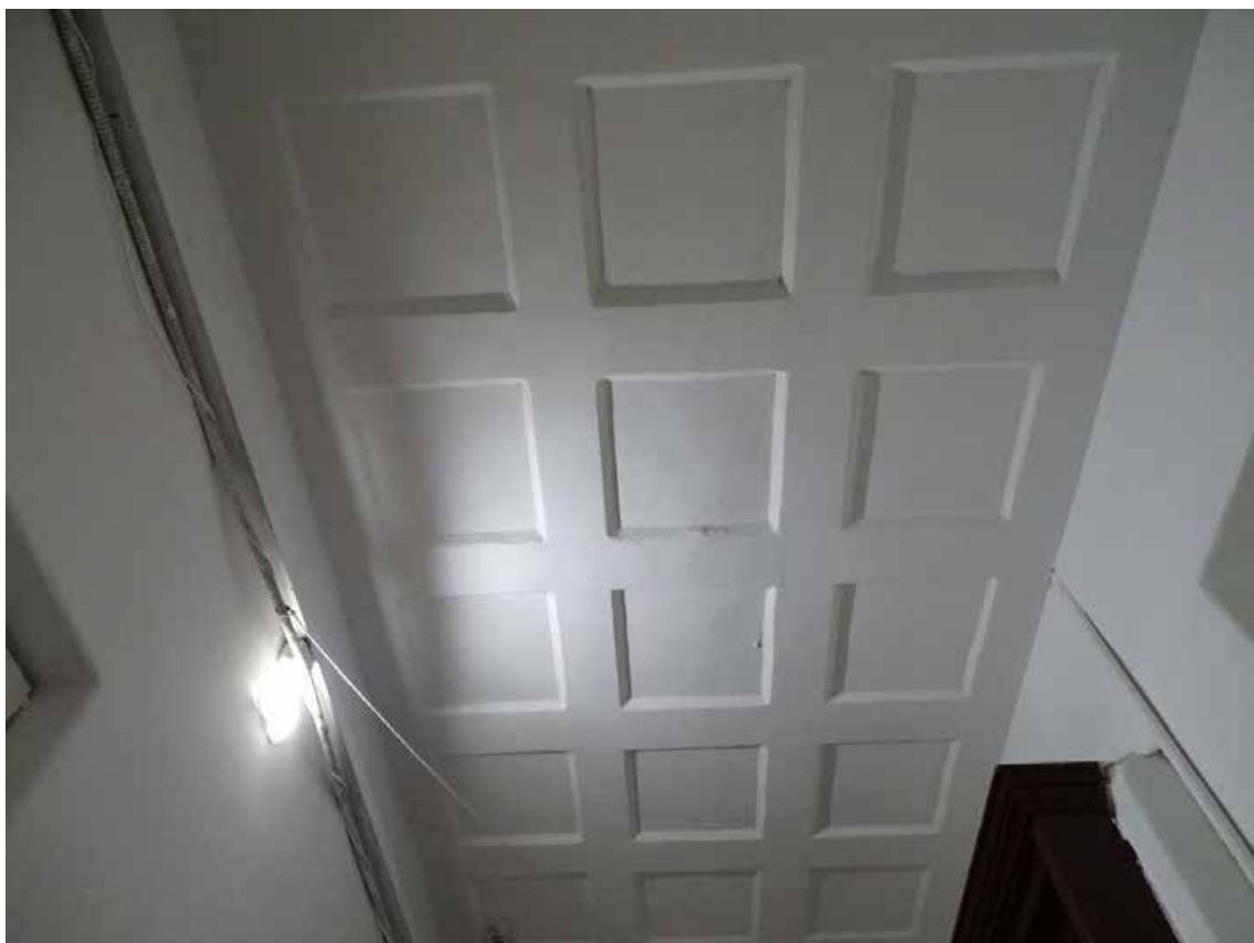
Фото 434. ЛК-6. Вестибюль 1-го этажа. Оформление потолка. Съемка 19.04.2021 г. Трушковский В.Э.
