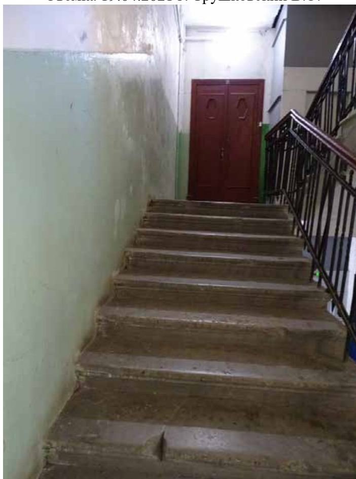
Фото 287. ЛК-1. Площадка 2-го этажа. Съемка 19.04.2021 г. Трушковский В.Э.
