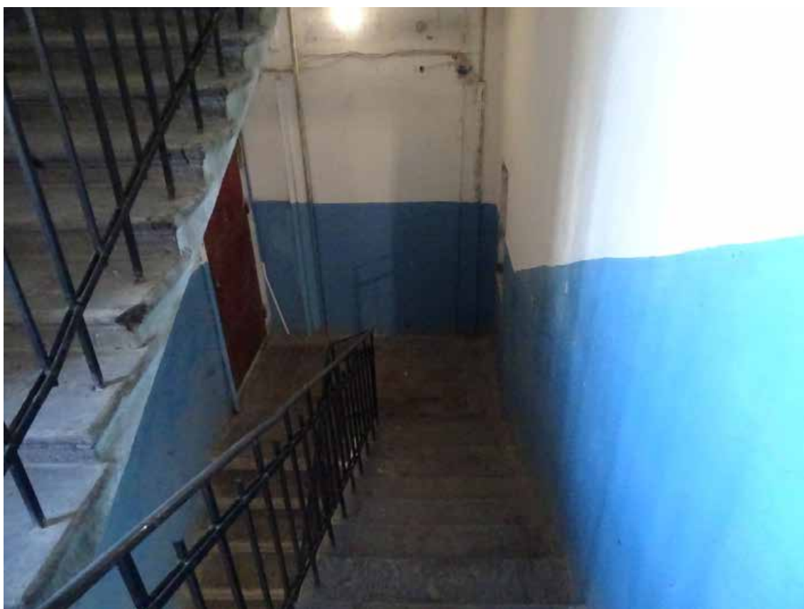
Фото 411. ЛК-5. Вид на площадку 4-го этажа. Съемка 19.04.2021 г. Трушковский В.Э.
