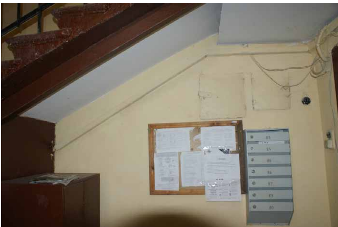
Фото 515. ЛК-9. Вестибюль 1-го этажа. Съемка 19.04.2021 г. Трушковский В.Э.
