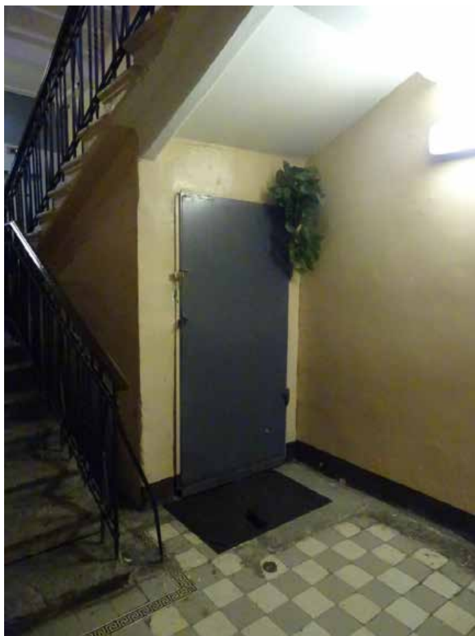
Фото 350. ЛК-3. Вестибюль 1-го этажа. Съемка 19.04.2021 г. Трушковский В.Э.
