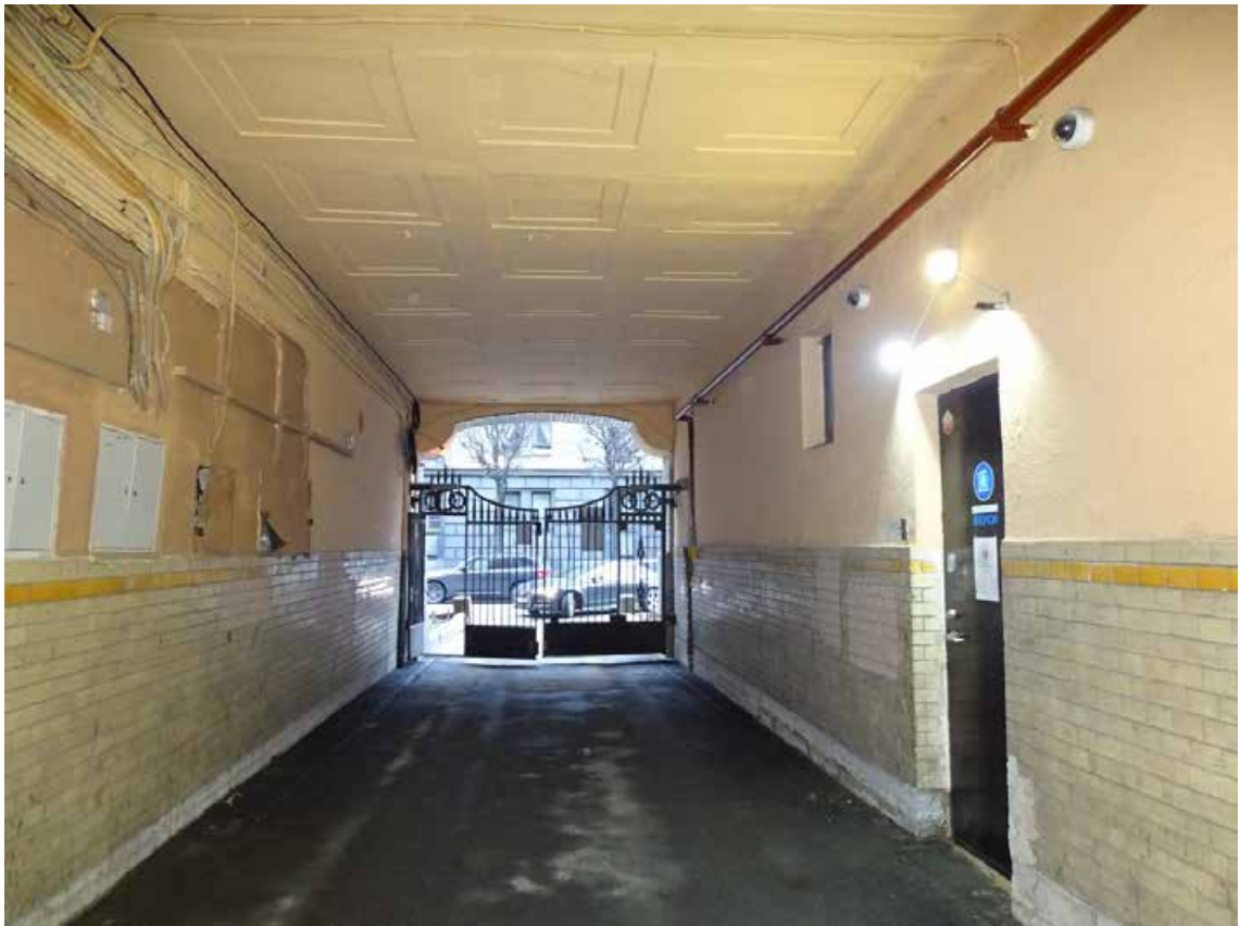
Фото 25. Здание по адресу: г. Санкт-Петербург, Большая Монетная ул., дом 29, литера А. Оформление воротного проезда. Съемка 19.04.2021 г. Трушковский В.Э.
