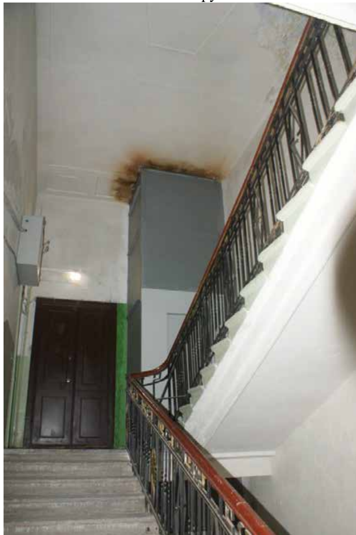
Фото 307. ЛК-1. Вид на площадку 6-го этажа. Съемка 19.04.2021 г. Трушковский В.Э.
