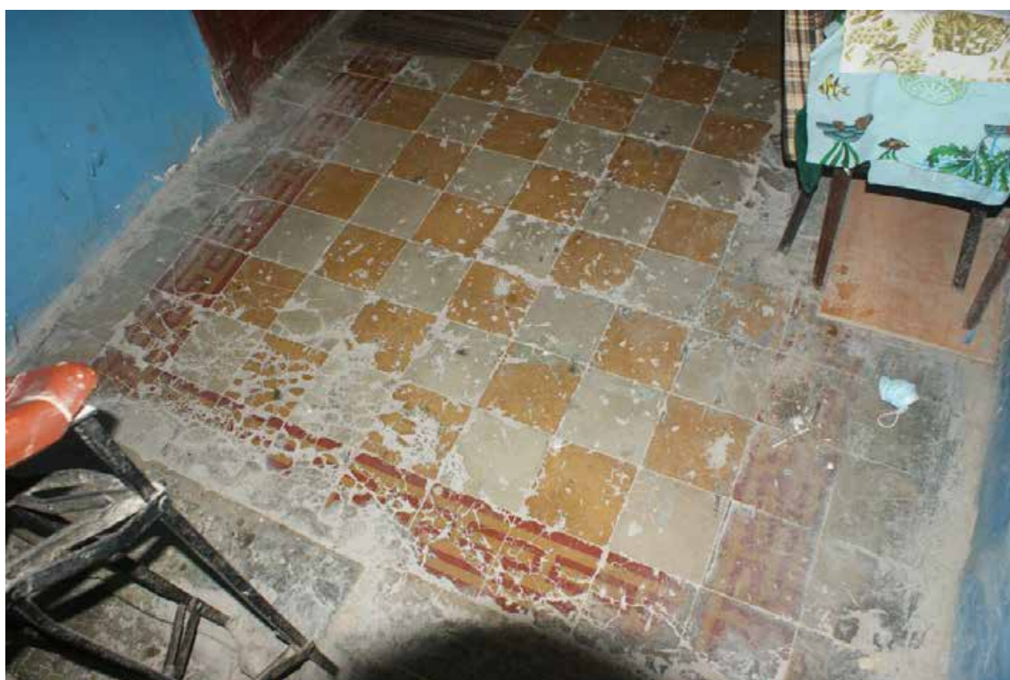
Фото 393. ЛК-5. Площадка 1-го этажа. Съемка 19.04.2021 г. Трушковский В.Э.
