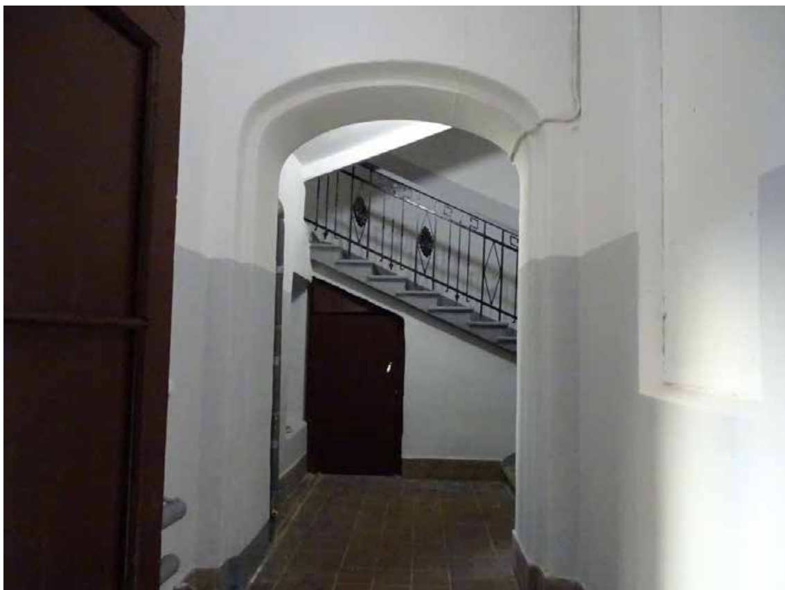
Фото 436. ЛК-6. Вестибюль 1-го этажа. Съемка 19.04.2021 г. Трушковский В.Э.
