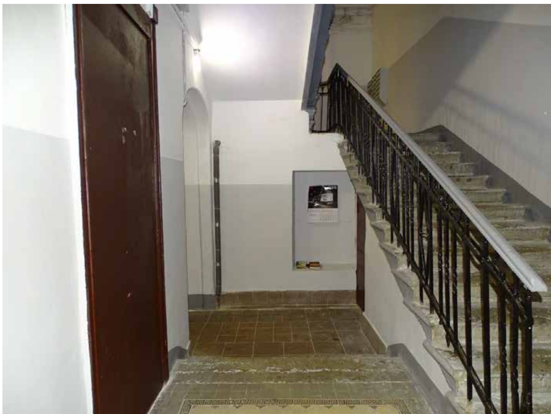
Фото 439. ЛК-6. Площадка 1-го этажа. Съемка 19.04.2021 г. Трушковский В.Э.
