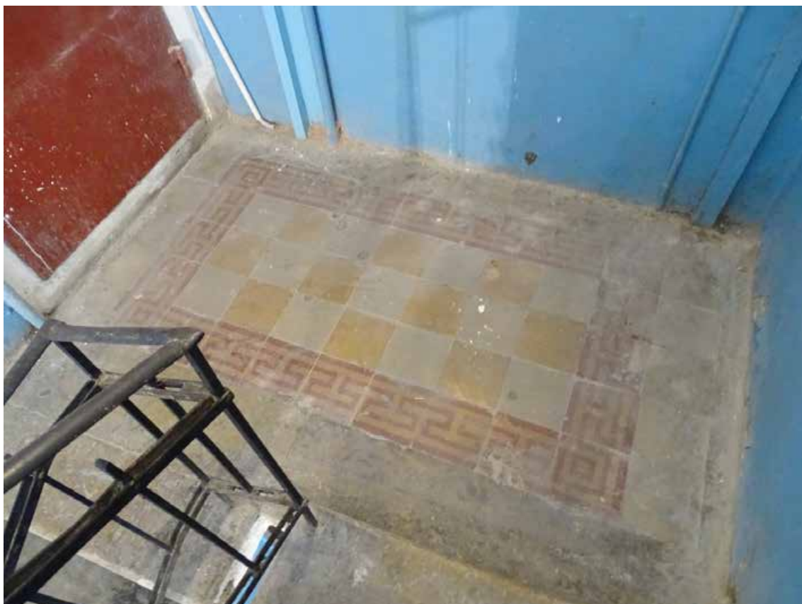
Фото 412. ЛК-5. Площадка 4-го этажа. Покрытие пола. Съемка 19.04.2021 г Трушковский В.Э.
