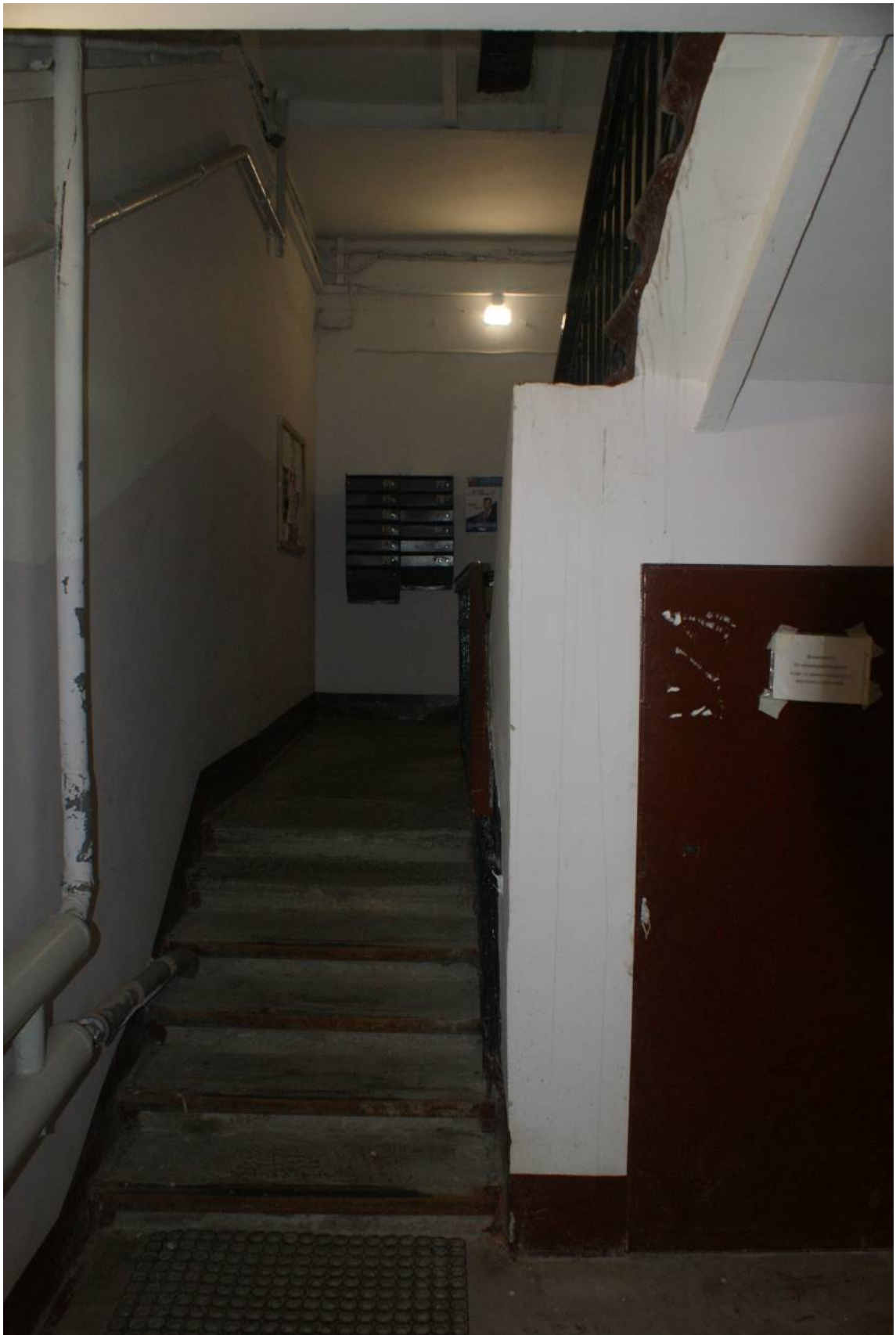
Фото 312. ЛК-2. Вестибюль 1-го этажа. Съемка 19.04.2021 г. Трушковский В.Э.
