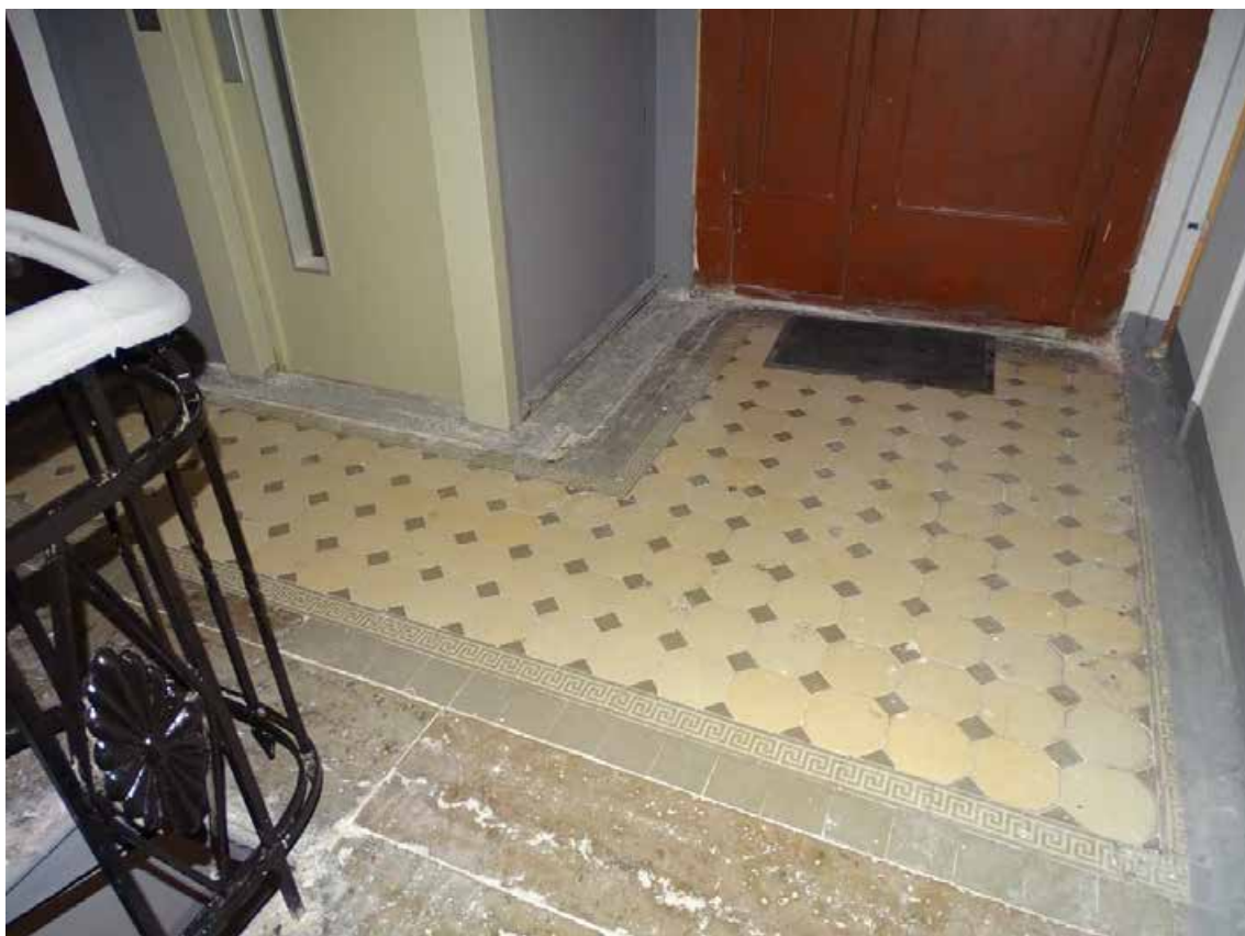
Фото 456. ЛК-6. Площадка 3-го этажа. Съемка 19.04.2021 г. Трушковский В.Э.
