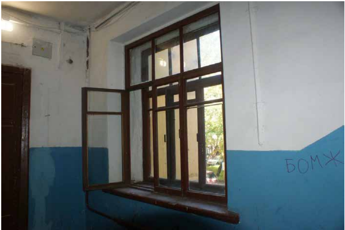
Фото 397. ЛК-5. Площадка между 1-м и 2-м этажом. Оформление окна. Съемка 19.04.2021 г. Трушковский В.Э.
