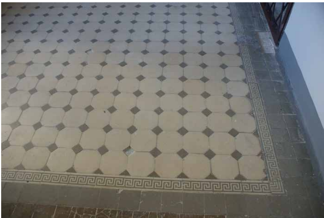
Фото 477. ЛК-6. Вид на площадку между 6-м и чердачным этажом. Покрытие пола. Съемка 19.04.2021 г. Трушковский В.Э.
