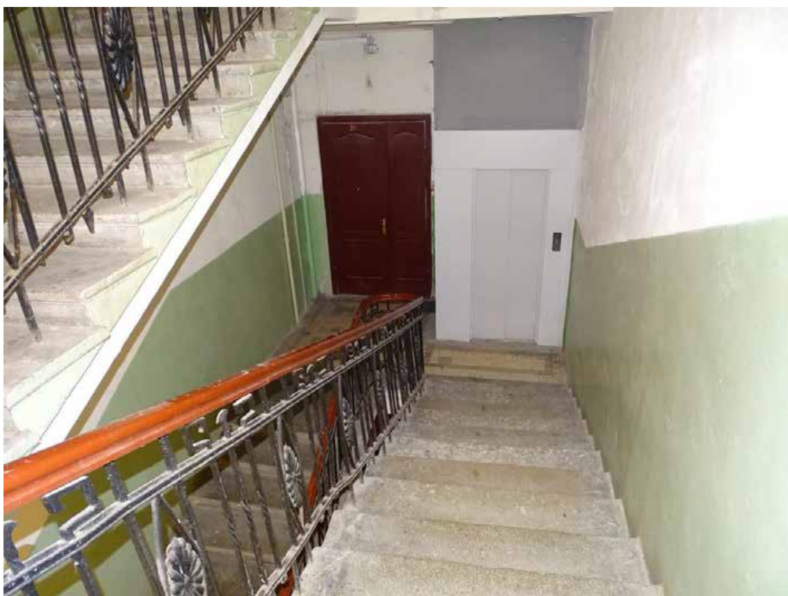
Фото 295. ЛК-1. Площадка 3-го этажа. Съемка 19.04.2021 г. Трушковский В.Э.
