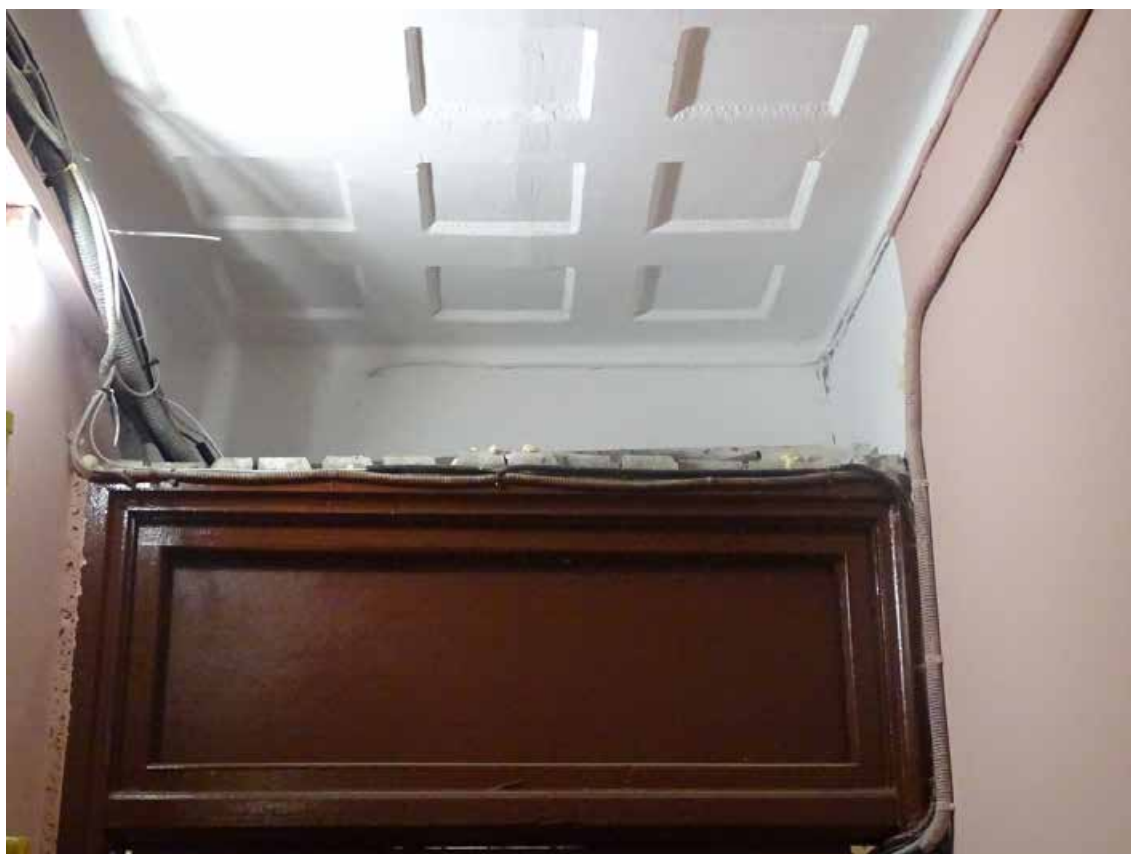
Фото 484. ЛК-8. Вестибюль 1-го этажа. Съемка 19.04.2021 г. Трушковский В.Э.
