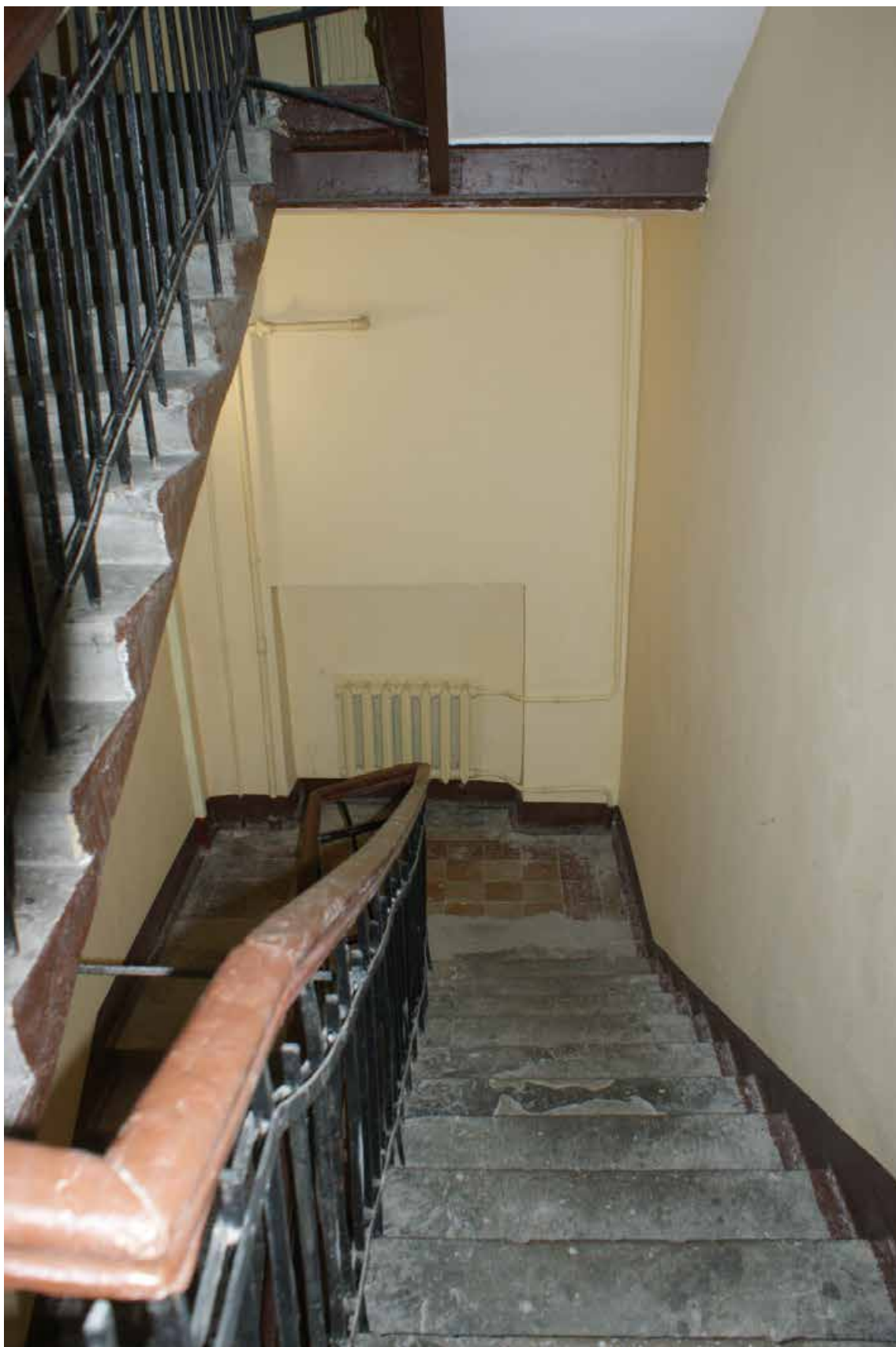
Фото 531. ЛК-9. Вид на площадку между 4-м и 5-м этажом. Съемка 19.04.2021 г. Трушковский В.Э.
