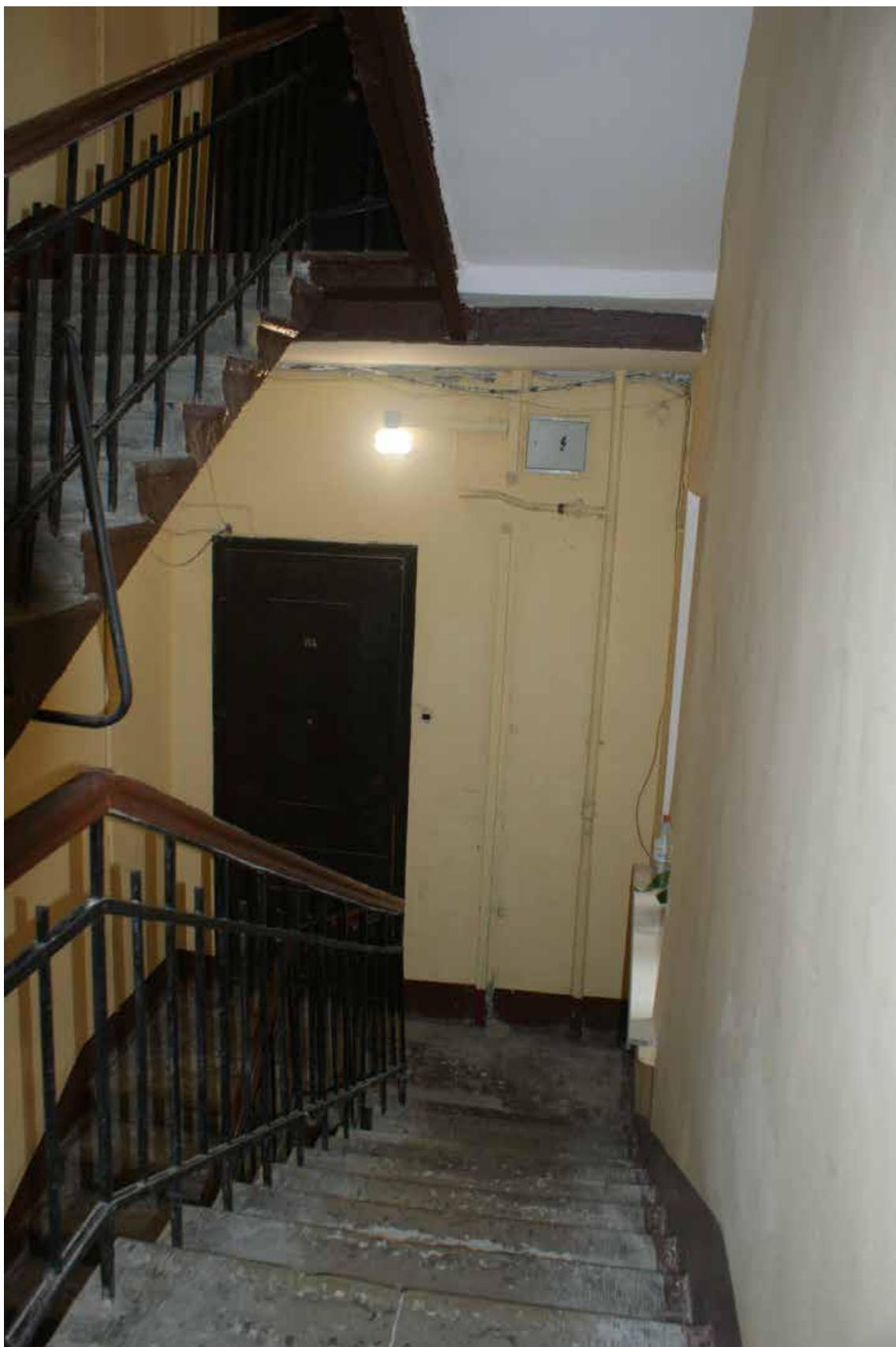
Фото 521. ЛК-9. Вид на площадку 2-го этажа. Съемка 19.04.2021 г. Трушковский В.Э.
