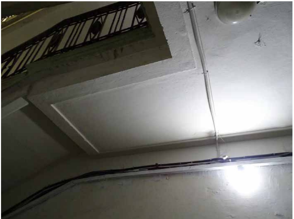
Фото 283. ЛК-1. Площадка 1-го этажа. Съемка 19.04.2021 г. Трушковский В.Э.
