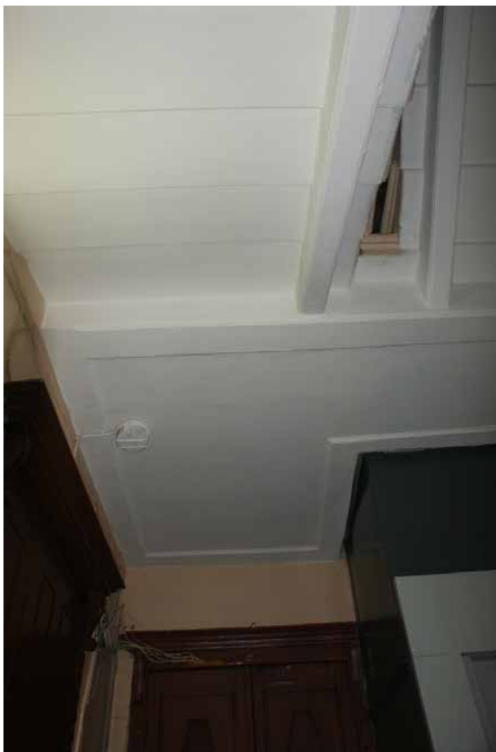
Фото 372. ЛК-3. Площадка 4-го этажа. Съемка 19.04.2021 г. Трушковский В.Э.
