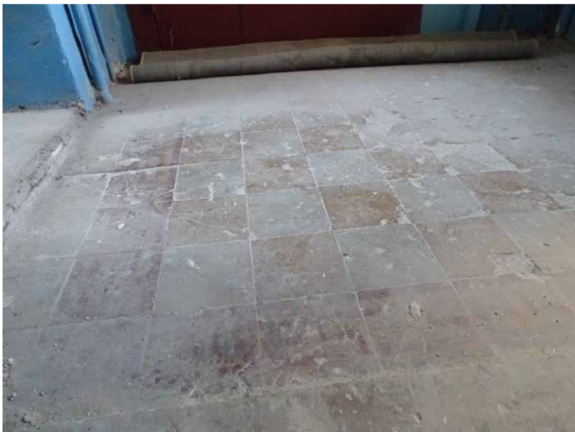
Фото 428. ЛК-5. Площадка между 6-м и чердачным этажом. Съемка 19.04.2021 г. Трушковский В.Э.
