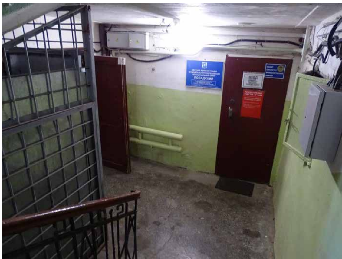
Фото 279. ЛК-1. Площадка 1-го этажа. Пространство под лестницей. Съемка 19.04.2021 г. Трушковский В.Э.
