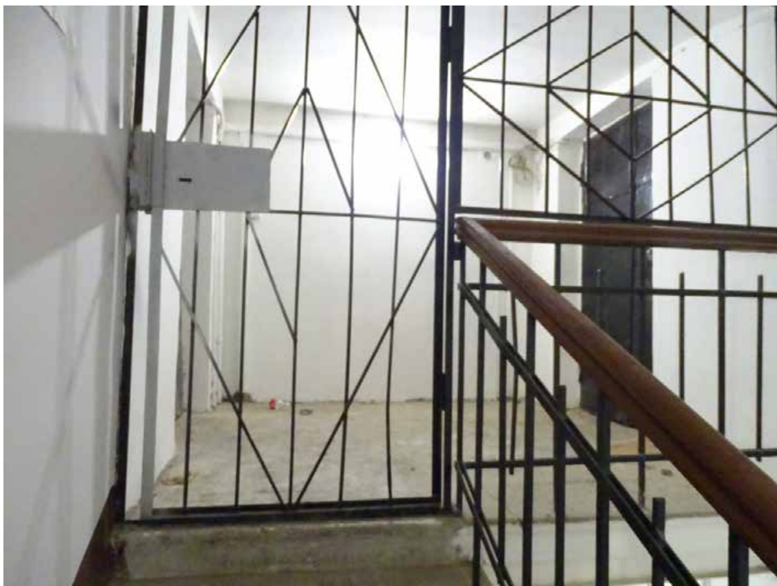
Фото 340. ЛК-2. Площадка чердачного этажа. Съемка 19.04.2021 г. Трушковский В.Э.
