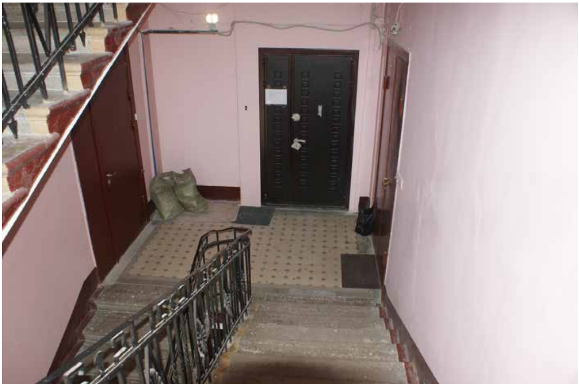
Фото 507. ЛК-8. Вид на площадку 5-го этажа. Съемка 19.04.2021 г. Трушковский В.Э.
