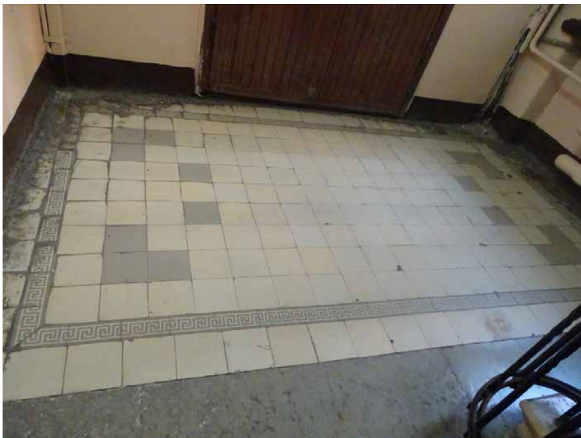
Фото 354. ЛК-3. Площадка между 1-м и 2-м этажом. Покрытие пола. Съемка 19.04.2021 г. Трушковский В.Э.
