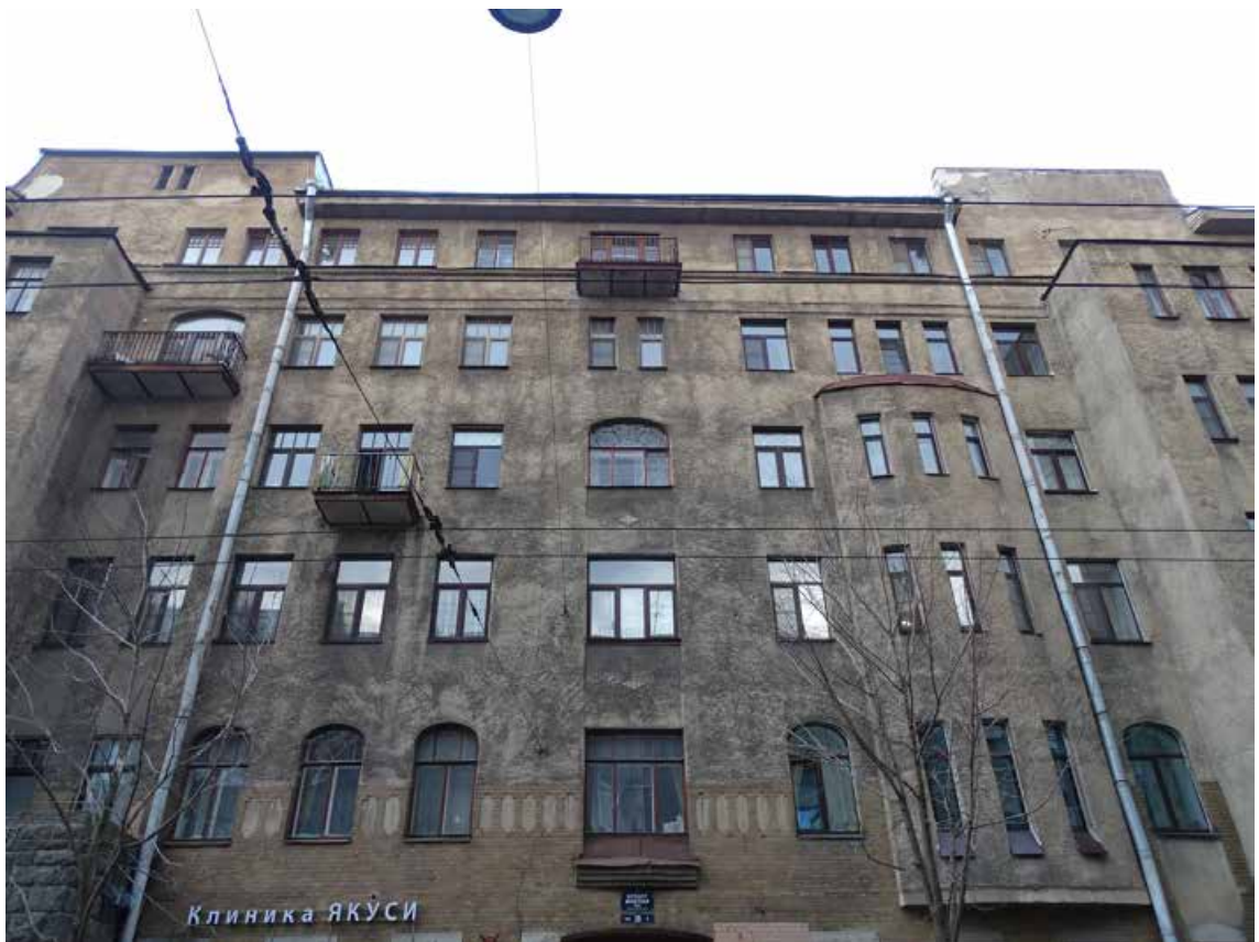
Фото 9. Здание по адресу: г. Санкт-Петербург, Большая Монетная ул., дом 29, литера А. Фрагмент фасада по Большой Монетной ул. Съемка 19.04.2021 г. Трушковский В.Э.
