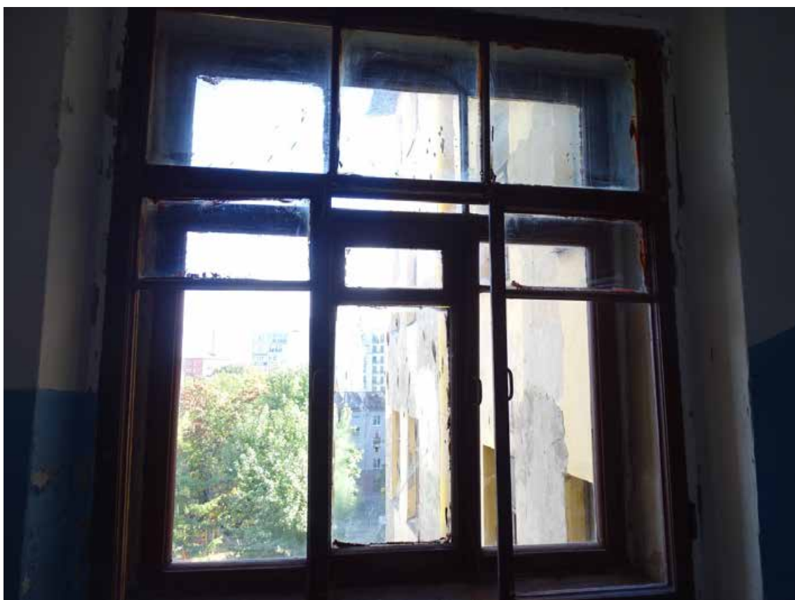
Фото 423. ЛК-5. Площадка между 5-м и 6-м этажом. Оформление окна. Съемка 19.04.2021 г. Трушковский В.Э.
