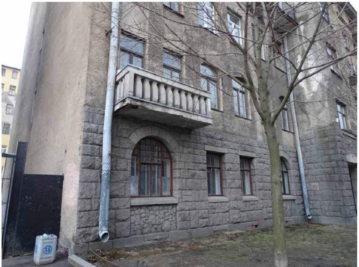
Фото 14. Здание по адресу: г. Санкт-Петербург, Большая Монетная ул., дом 29, литера А. Фрагмент фасада по Большой Монетной ул. Балкон 2-го этажа. Съемка 19.04.2021 г. Трушковский В.Э.
