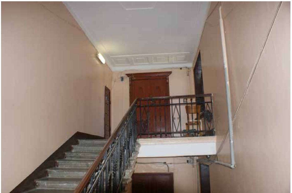
Фото 382. ЛК-3. Вид на площадку 6-го этажа. Съемка 19.04.2021 г. Трушковский В.Э.
