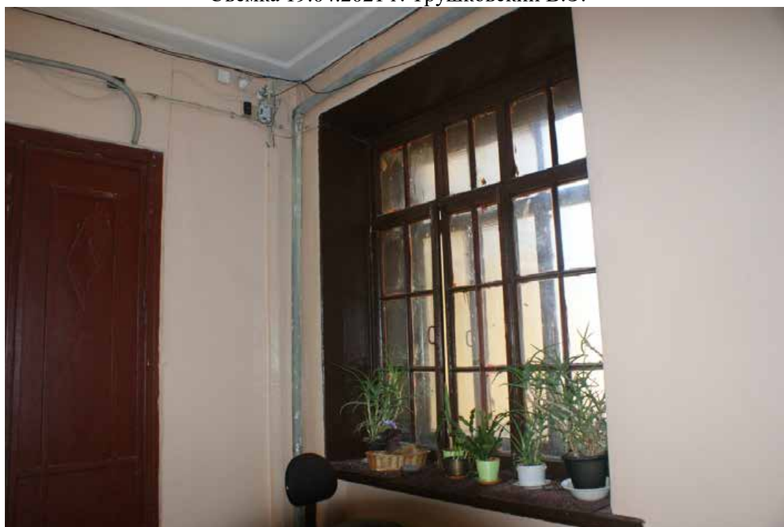
Фото 380. ЛК-3. Площадка между 5-м и 6-м этажом. Съемка 19.04.2021 г. Трушковский В.Э.
