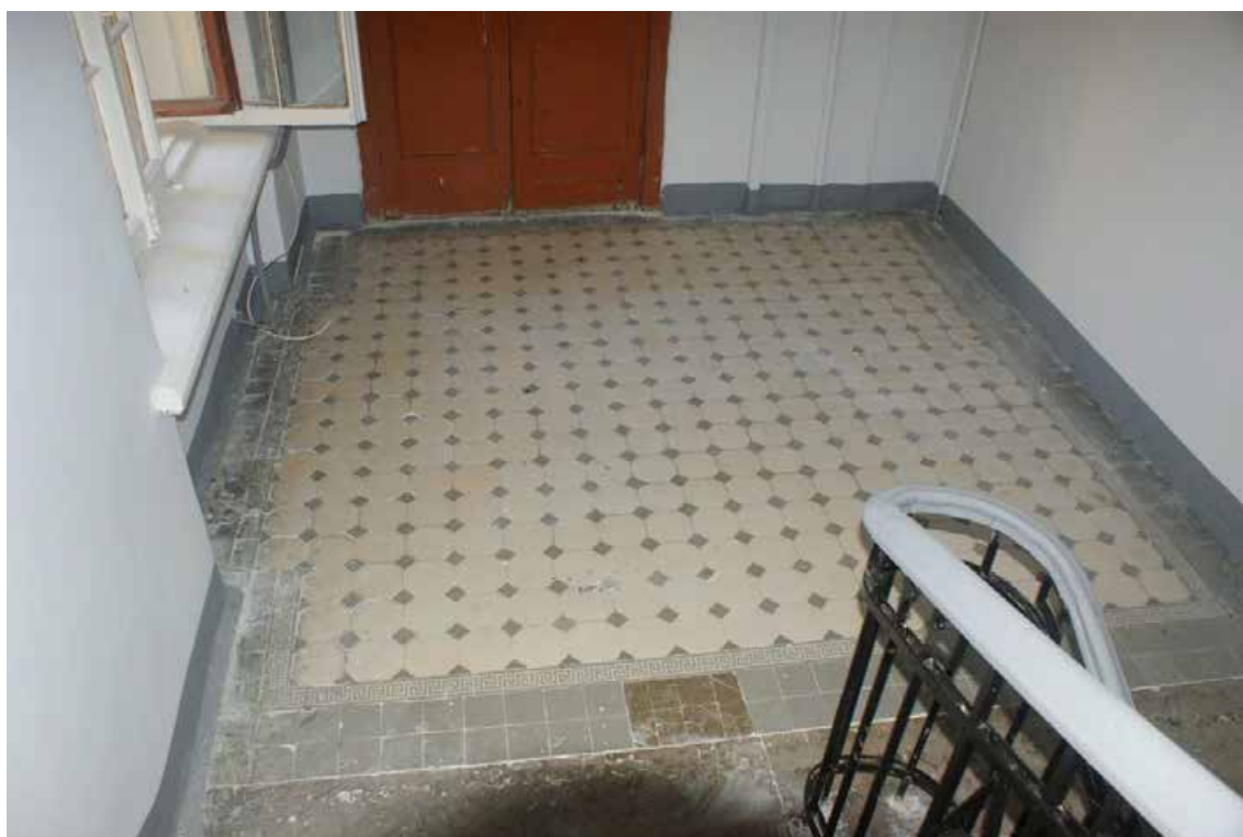
Фото 465. ЛК-6. Площадка между 4-м и 5-м этажом. Покрытие пола. Съемка 19.04.2021 г. Трушковский В.Э.
