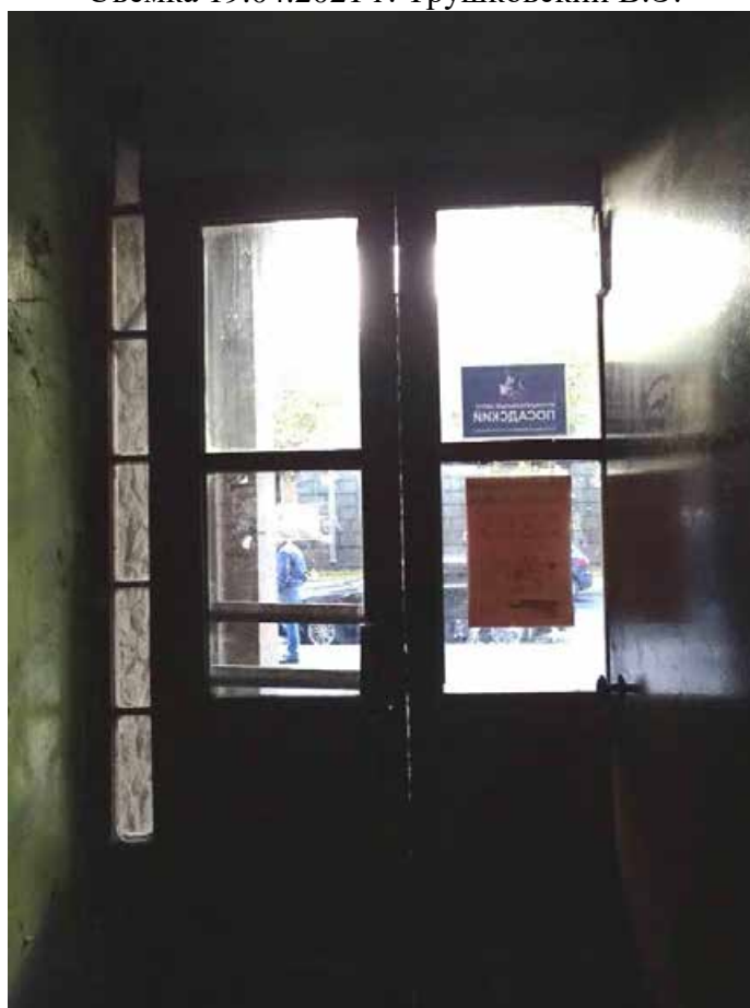
Фото 273. ЛК-1. Тамбур. 1-й этаж. Съемка 19.04.2021 г. Трушковский В.Э.
