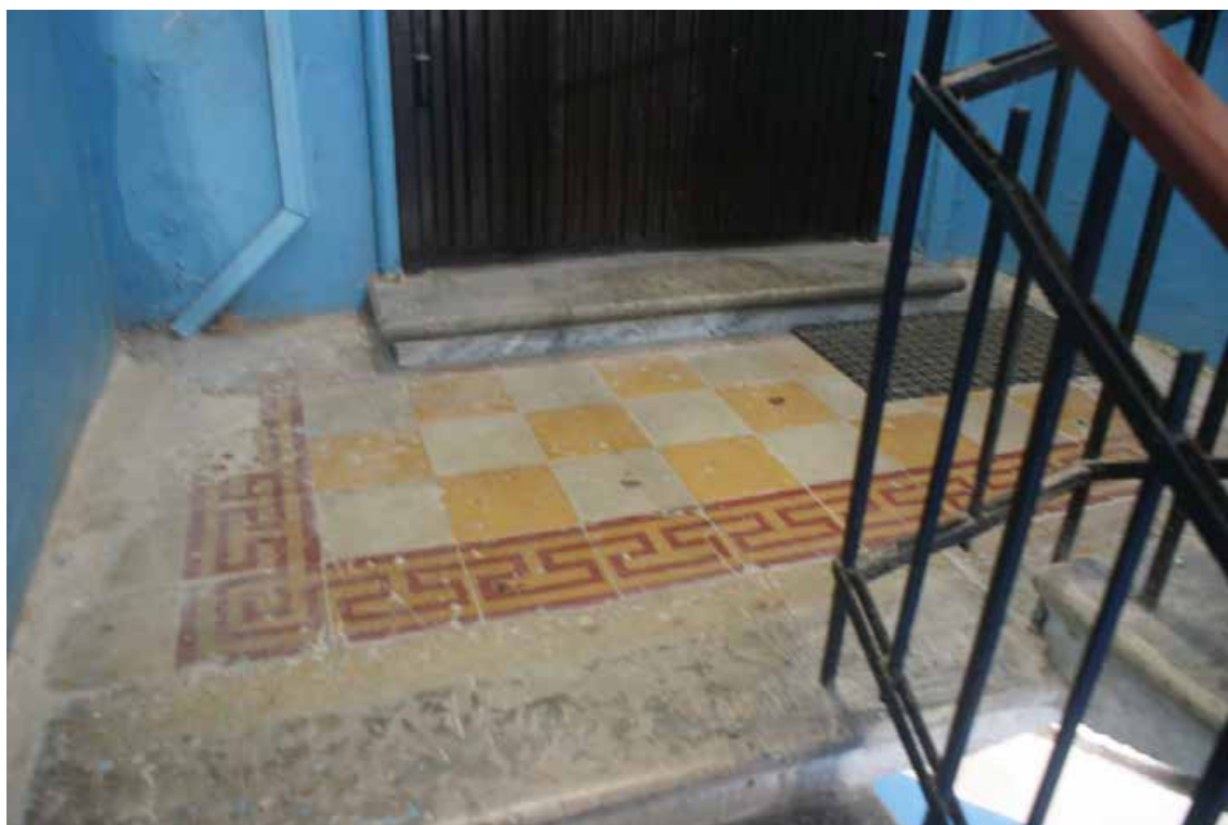
Фото 400. ЛК-5. Площадка 2-го этажа. Съемка 19.04.2021 г. Трушковский В.Э.
