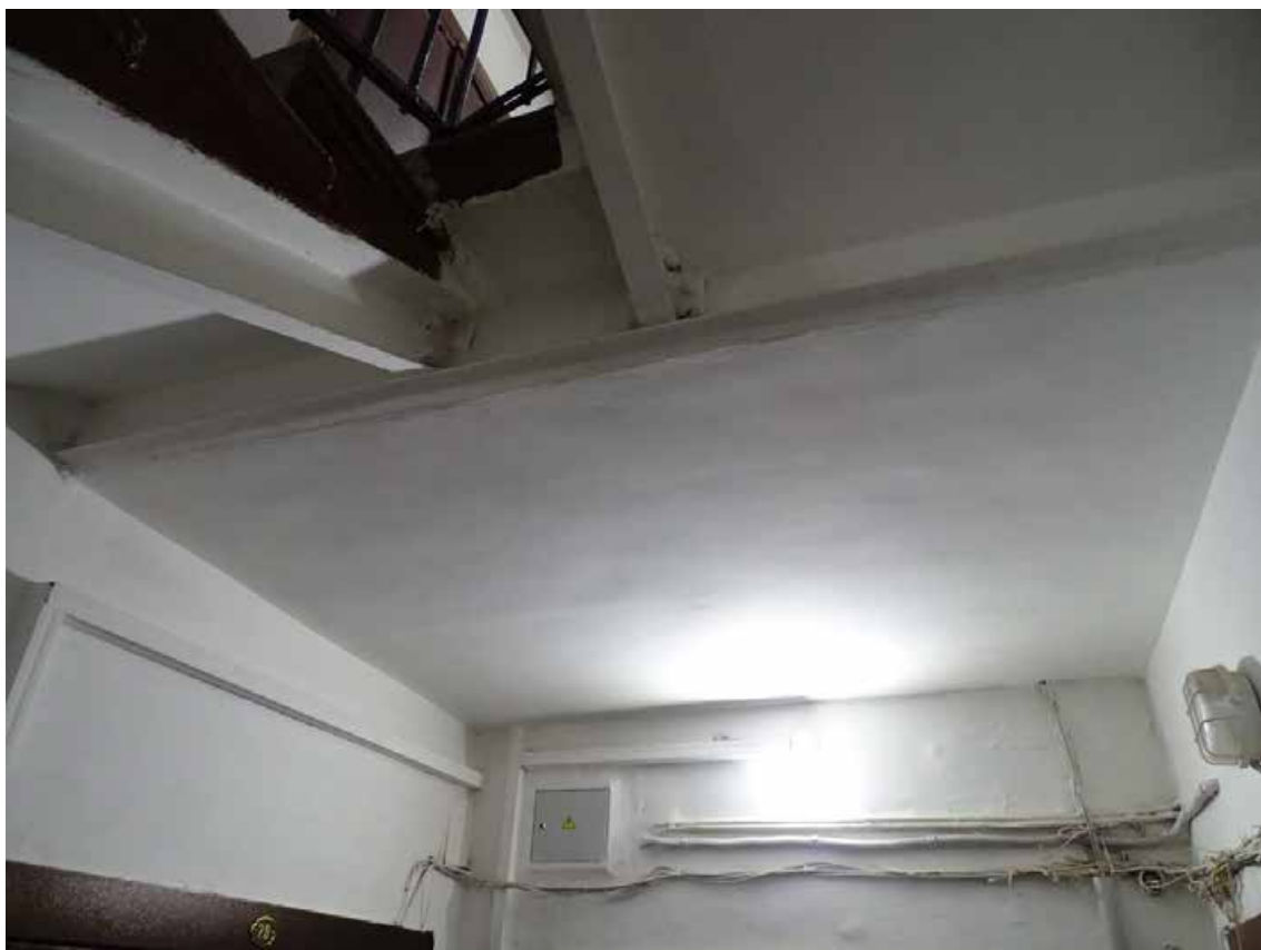
Фото 334. ЛК-2. Площадка 5-го этажа. Съемка 19.04.2021 г. Трушковский В.Э.
