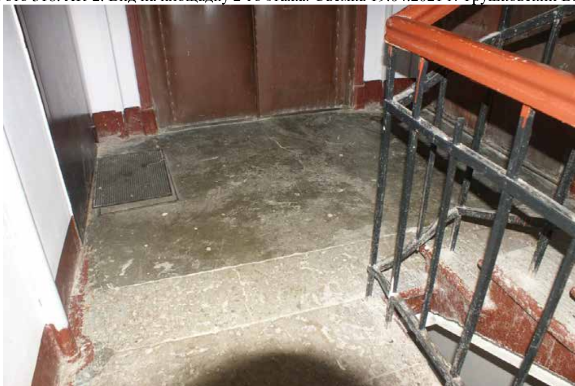
Фото 319. ЛК-2. Вид на площадку 2-го этажа. Съемка 19.04.2021 г. Трушковский В.Э.
