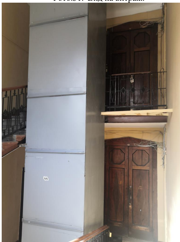
Фото.32. Общий вид на лестничную клетку. Шестой этаж.
