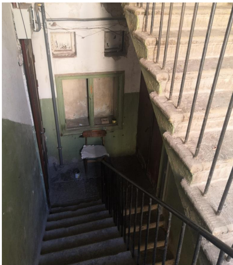
Фото.49. Вид на лестничную клетку. Типовой этаж.
