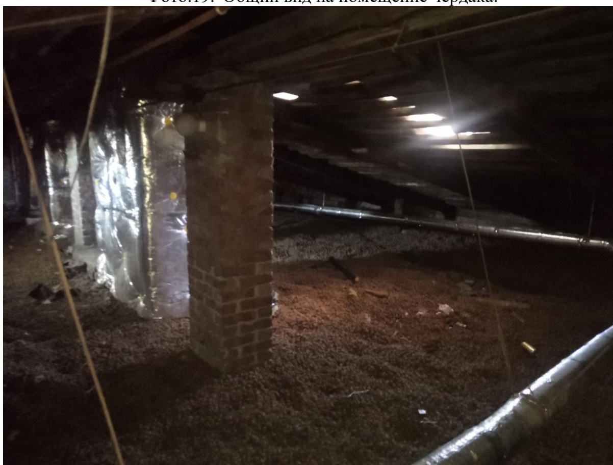
Фото.20. Общий вид на помещение чердака.
