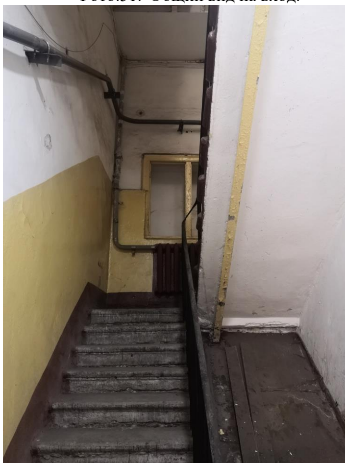
Фото.52. Вид на лестничную клетку. Первый этаж.
