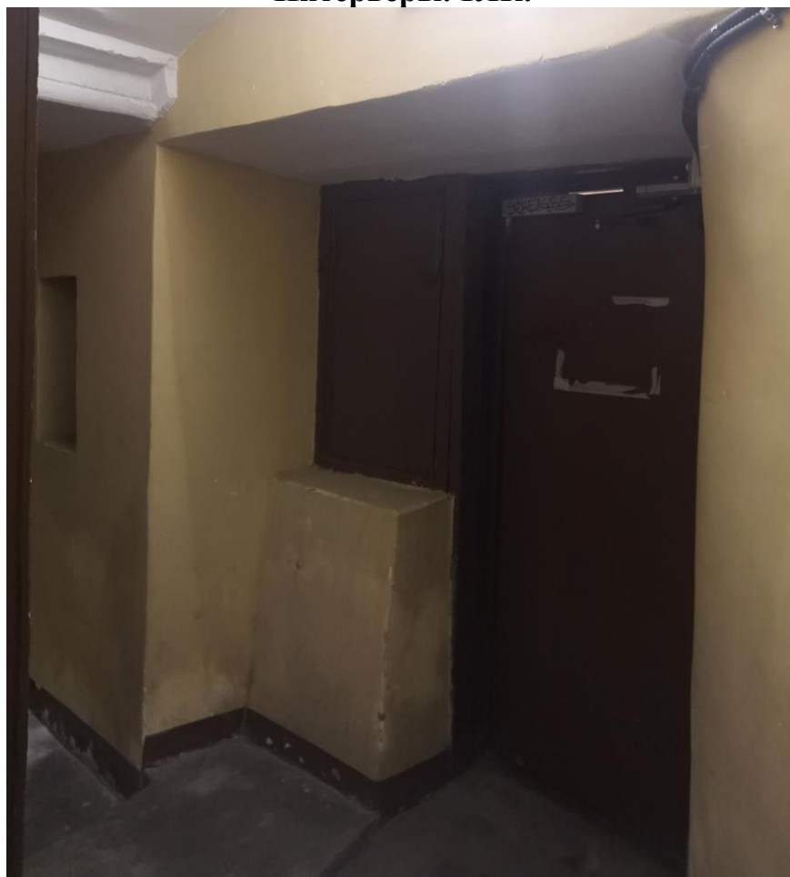
Фото.22. Общий вид на черный вход в парадную лестничную клетку.
