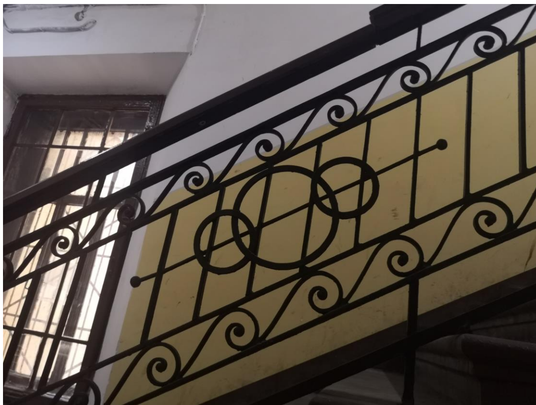
Фото.37. Вид на ограждение лестничной клетки.
