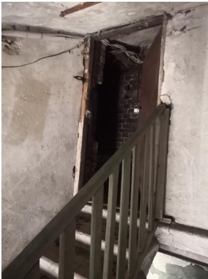
Фото.55. Вид на лестничную клетку. Шестой этаж. Интерьер. Южная черная лестничная клетка лицевого корпуса по ул. Петропавловской
