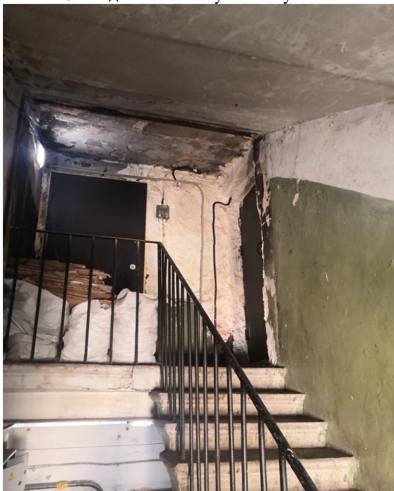
Фото.50. Вид на лестничную клетку. Шестой этаж.
