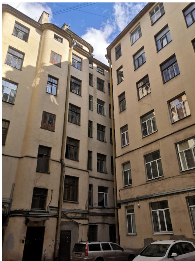
Фото.11. Вид на дворовой фасад.
