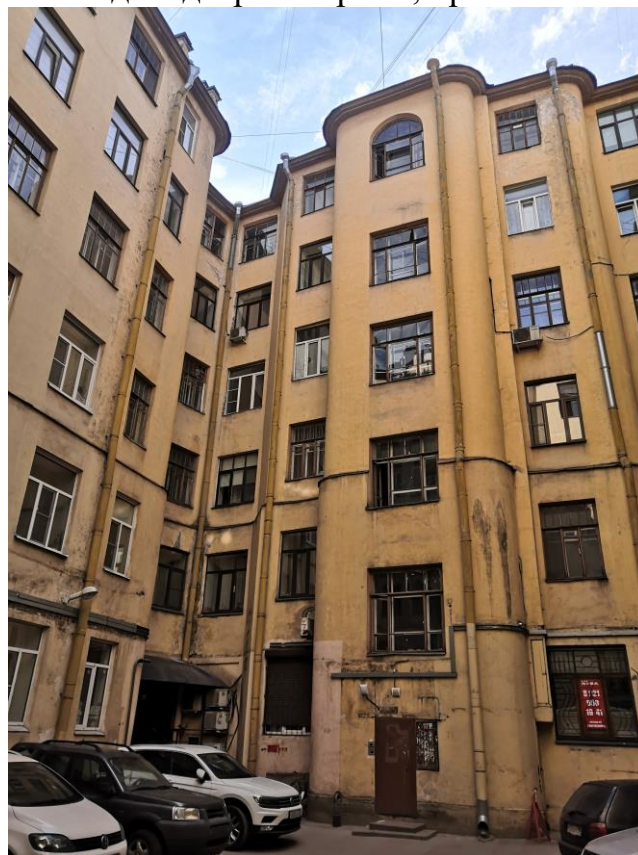
Фото.10. Вид на дворовой фасад.
