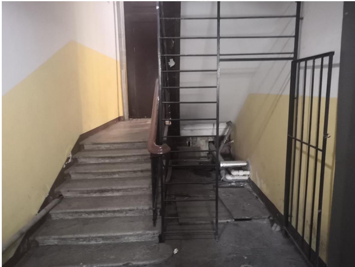
Фото.36. Общий вид на лестничную клетку. Первый этаж.
