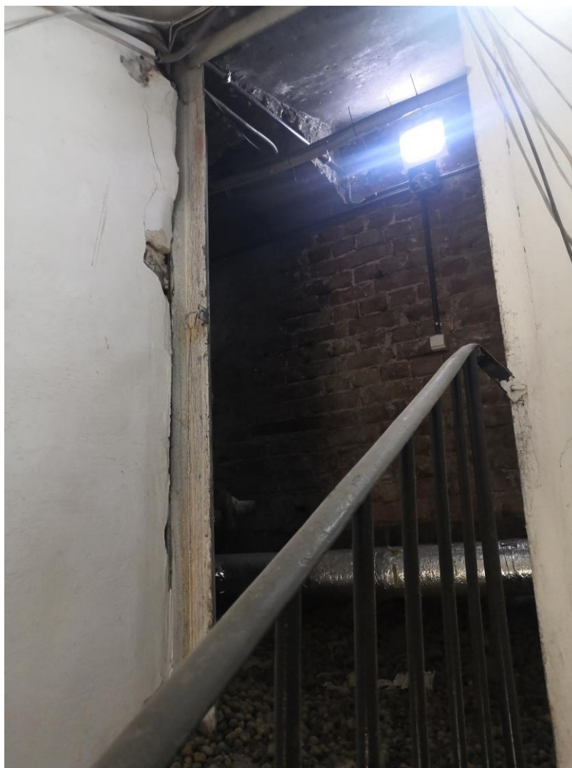
Фото.59. Вход на чердак. Шестой этаж.
