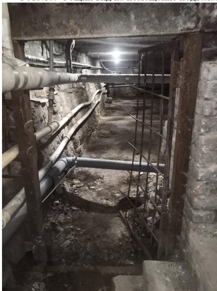
Фото.18. Общий вид на помещение подвала.
