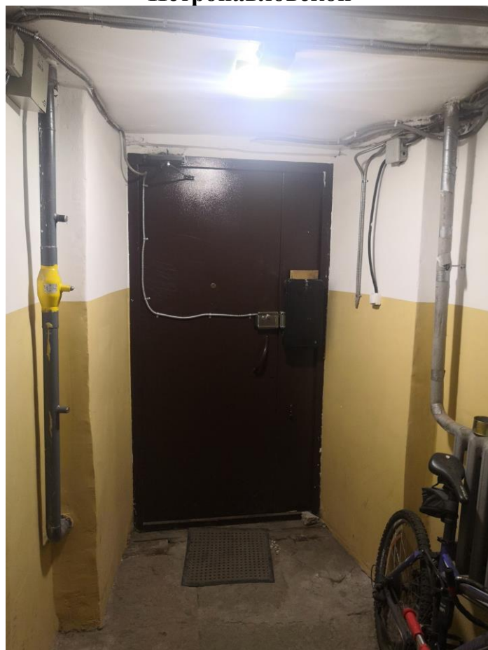
Фото.46. Вид на вход в черную лестницу.
