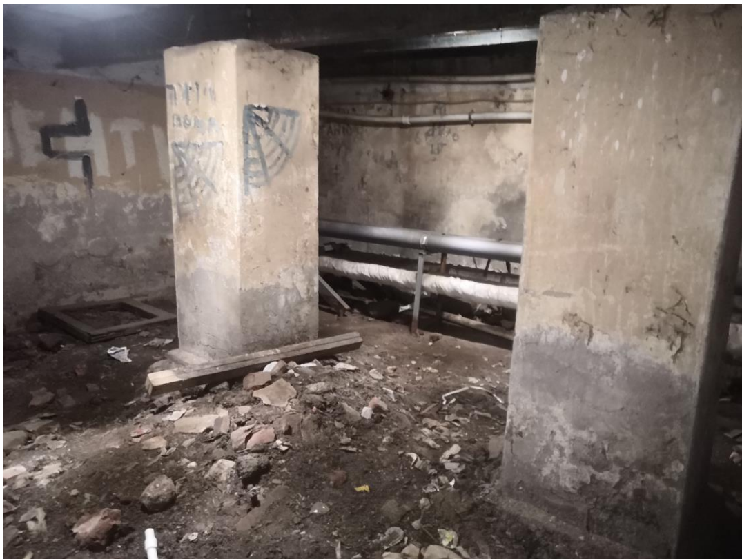
Фото.17. Общий вид на помещение подвала.
