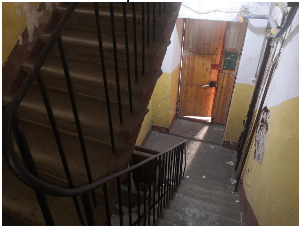
Фото.56. Вид на лестничную клетку. Первый этаж.
