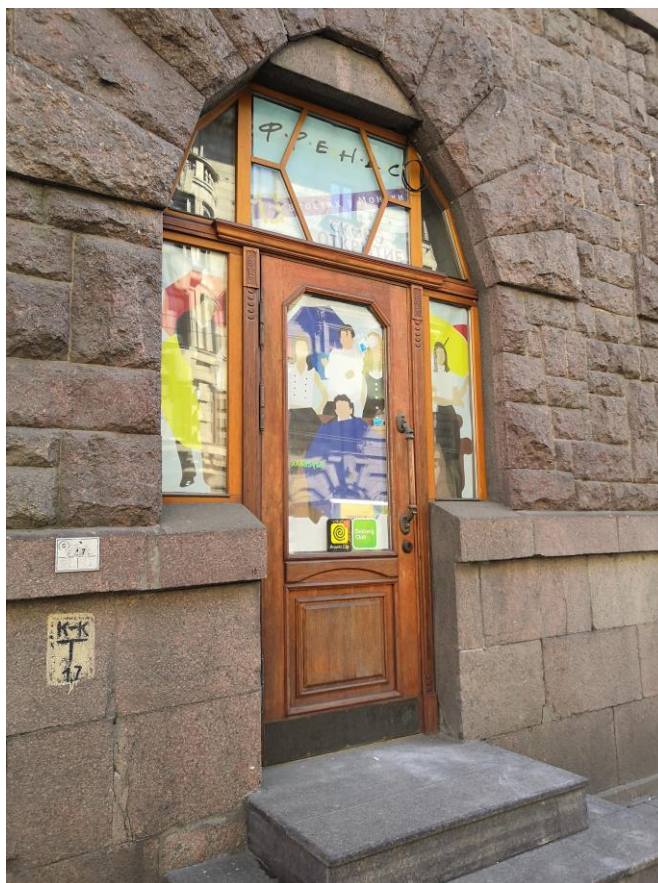
Фото.9. Вид на дверной проем, пробитый из оконного.
