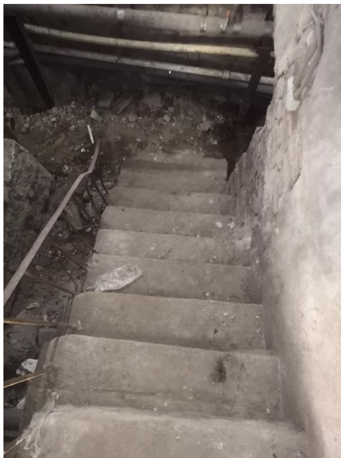
Фото.15. Общий вид на вход в подвал.
