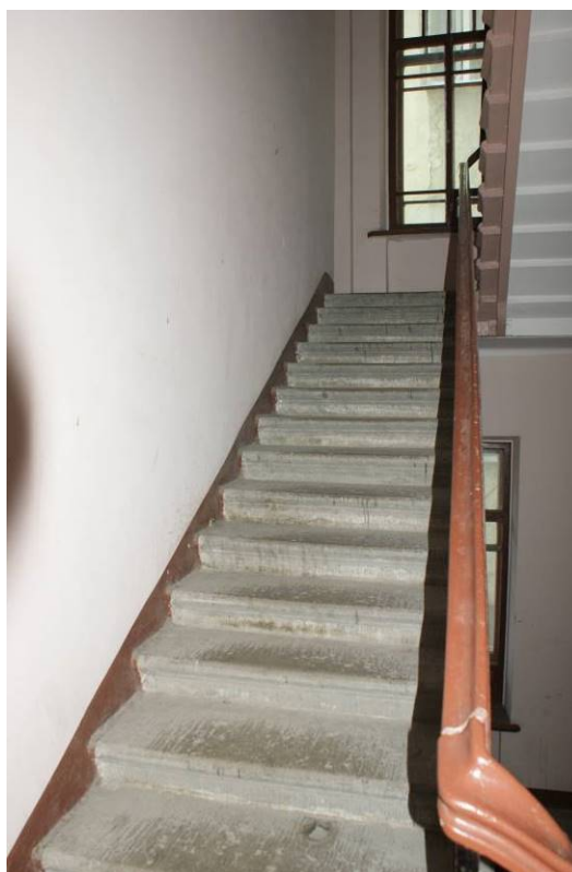
Фото 263. Лестница № 6: Лестничный марш на площадку между 3-м и 4-м этажом. Съемка 26.04.2021 г. Трушковский В.Э.
