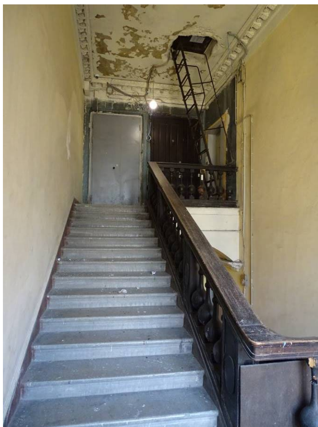
Фото 219. Лестница № 1: Площадка 6-го этажа. Съемка 26.04.2021 г. Трушковский В.Э.
