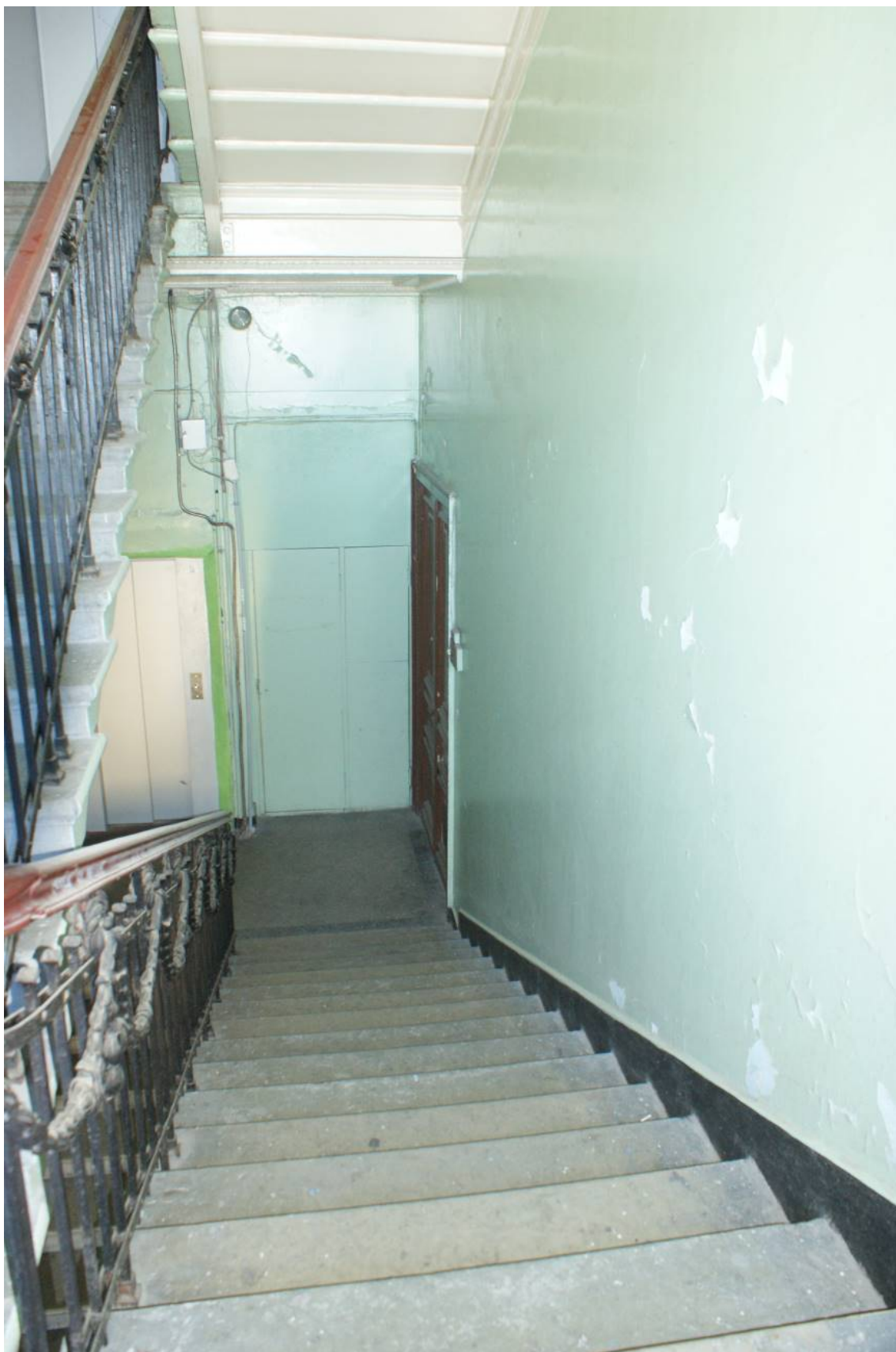
Фото 165. Лестница № 2: Площадка 4-го этажа. Съемка 26.04.2021 г. Трушковский В.Э.
