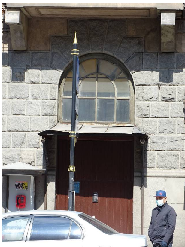
Фото 45. Здание по адресу: г. Санкт-Петербург, Кирочная ул., 22. Фрагмент лицевого фасада. Дверной проем. Съемка 26.04.2021 г. Трушковский В.Э.
