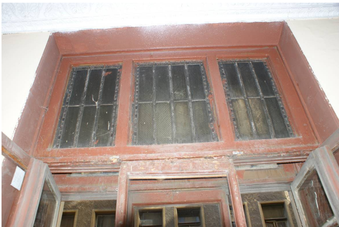
Фото 193. Лестница № 1: Площадка между 1-м и 2-м этажом. Оформление окна. Съемка 26.04.2021 г. Трушковский В.Э.
