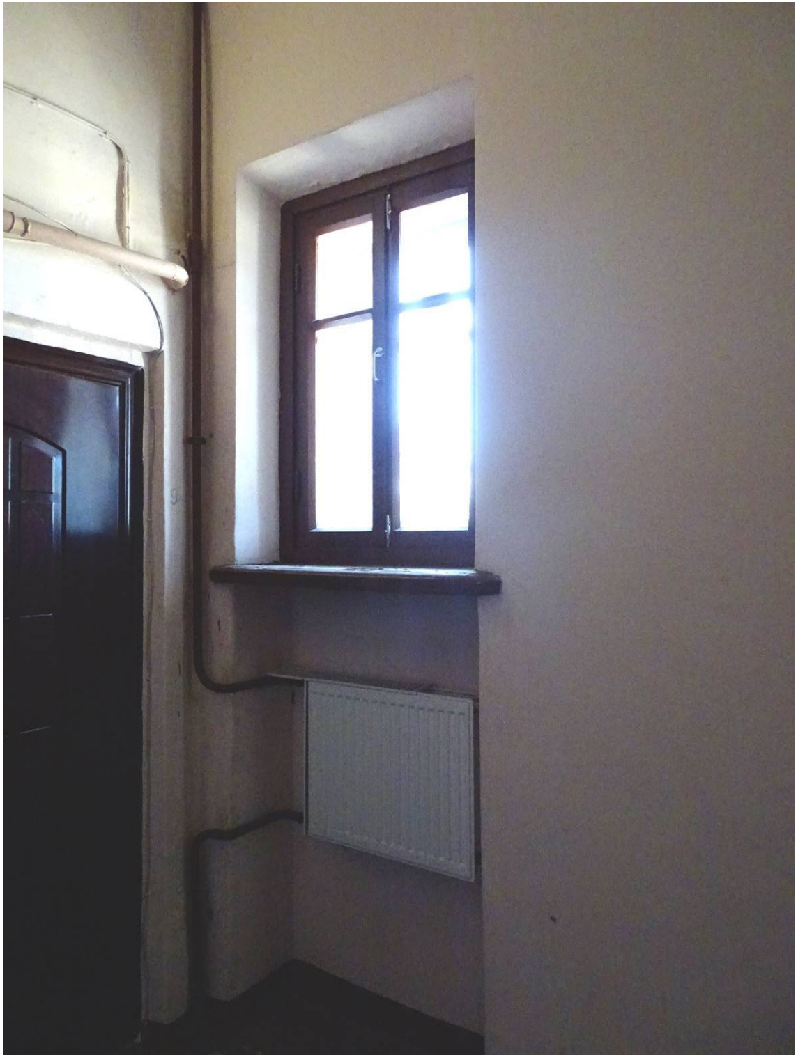
Фото 277. Лестница № 6: Площадка 6-го этажа. Съемка 26.04.2021 г. Трушковский В.Э.
