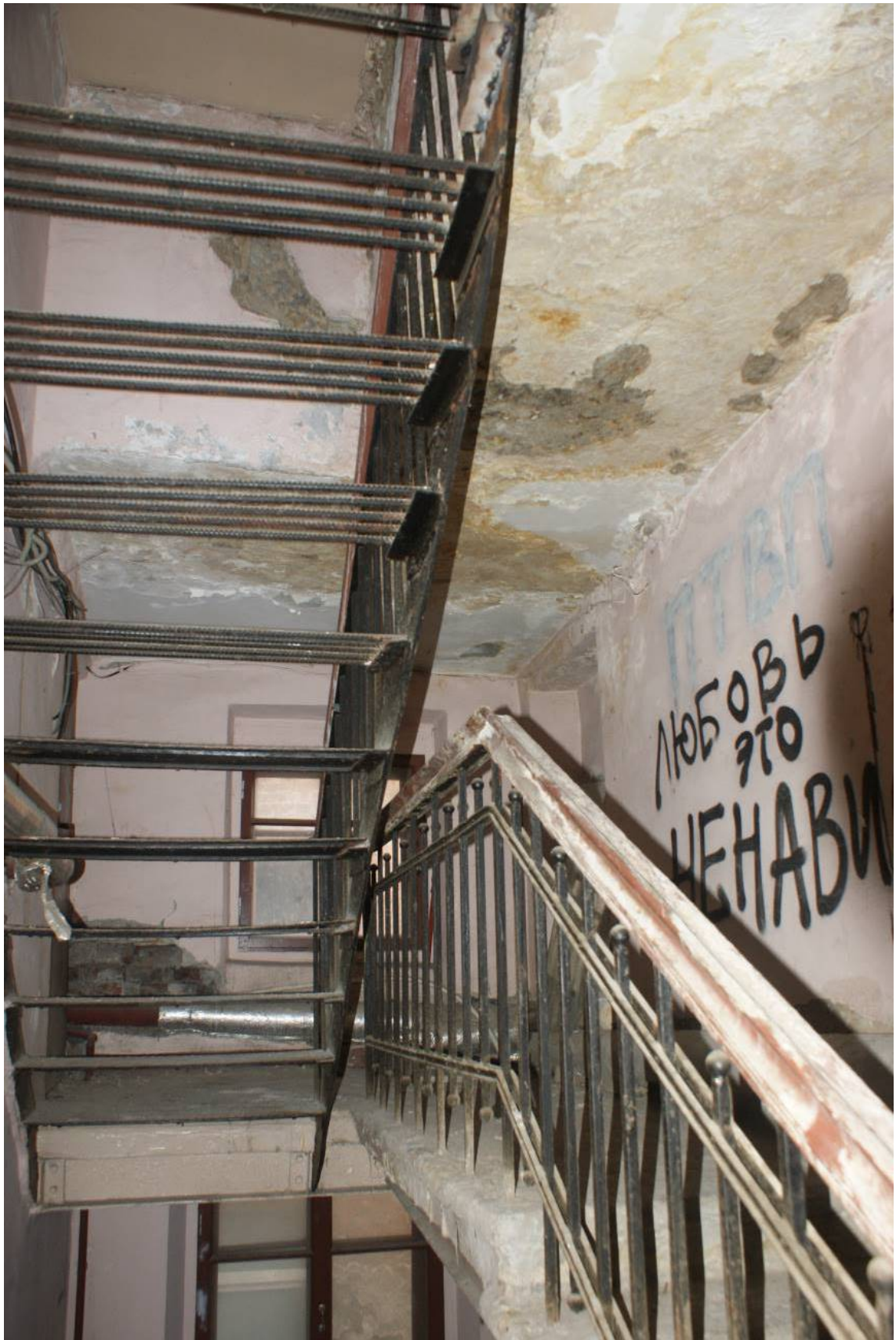
Фото 252. Лестница № 3: Площадка между техническим этажом и чердаком. Лестница на чердак. Съемка 26.04.2021 г. Трушковский В.Э.
