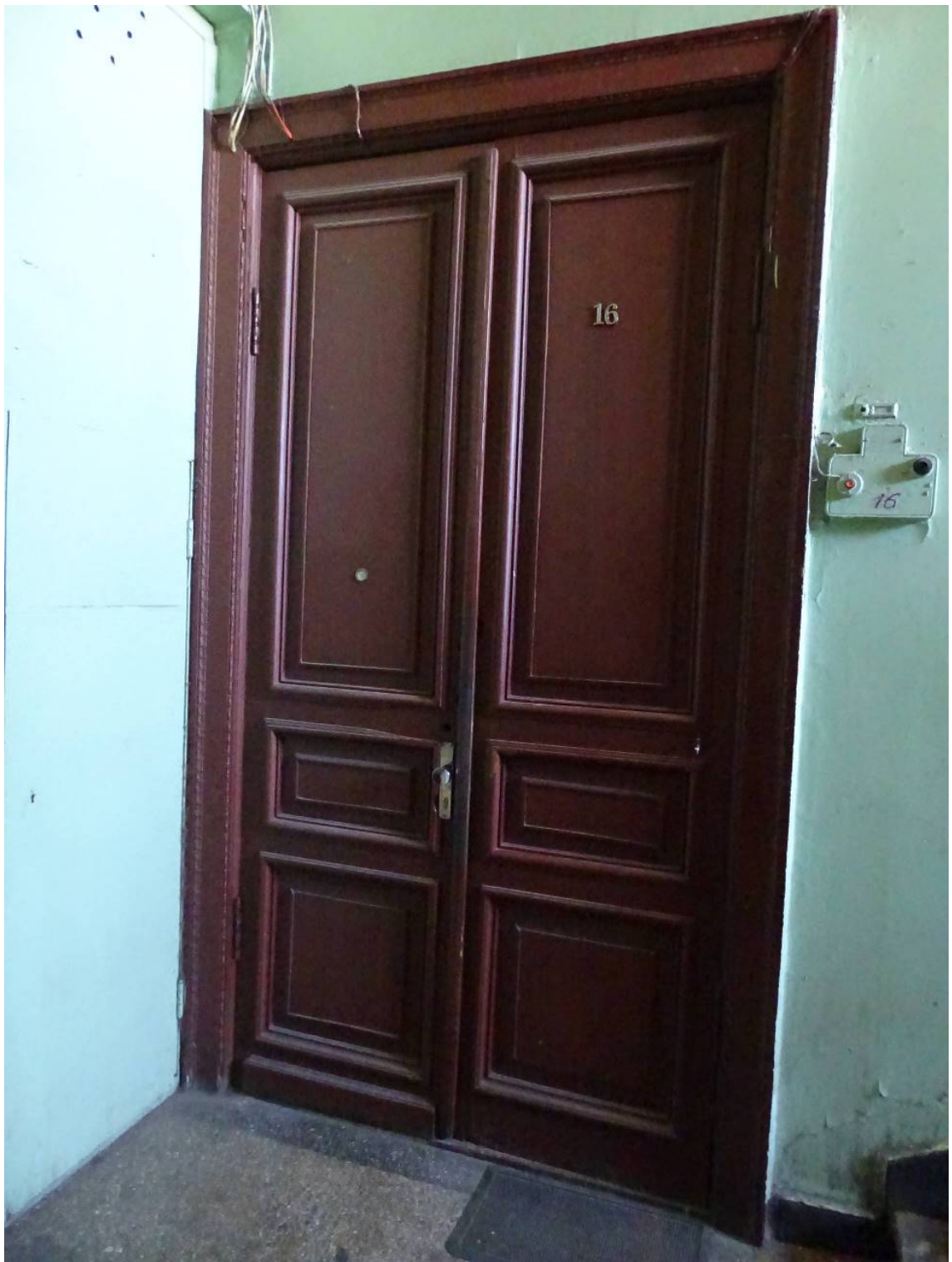
Фото 162. Лестница № 2: Площадка 3-го этажа. Оформление двери. Съемка 26.04.2021 г. Трушковский В.Э.
