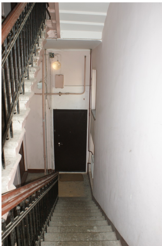
Фото 261. Лестница № 6: Площадка 3-го этажа. Съемка 26.04.2021 г. Трушковский В.Э.
