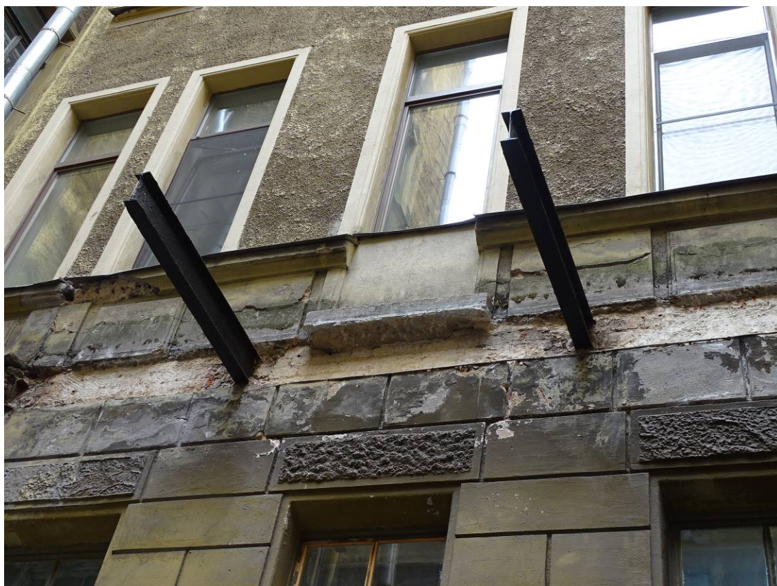
Фото 60. Здание по адресу: г. Санкт-Петербург, Кирочная ул., 22. Фрагмент западного фасада южного внутреннего двора. Съемка 26.04.2021 г. Трушковский В.Э.
