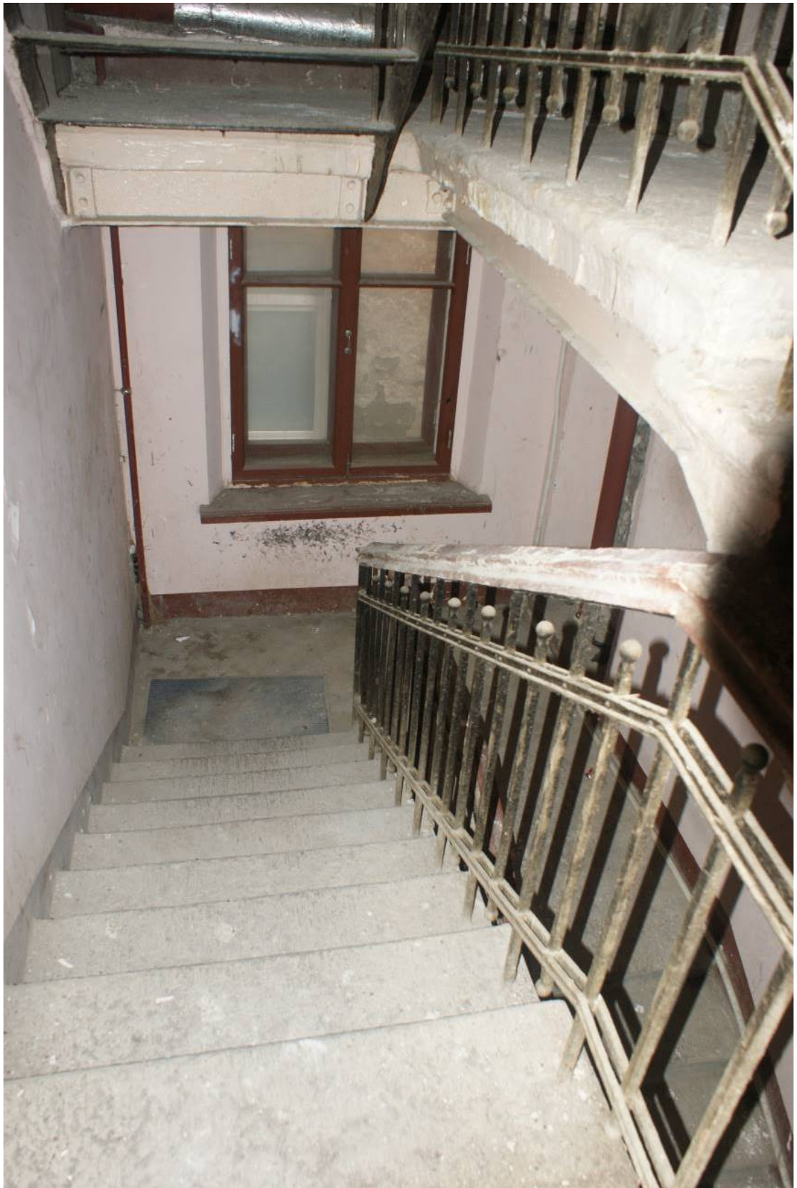
Фото 250. Лестница № 3: Площадка между 7-м и техническим этажом. Съемка 26.04.2021 г. Трушковский В.Э.
