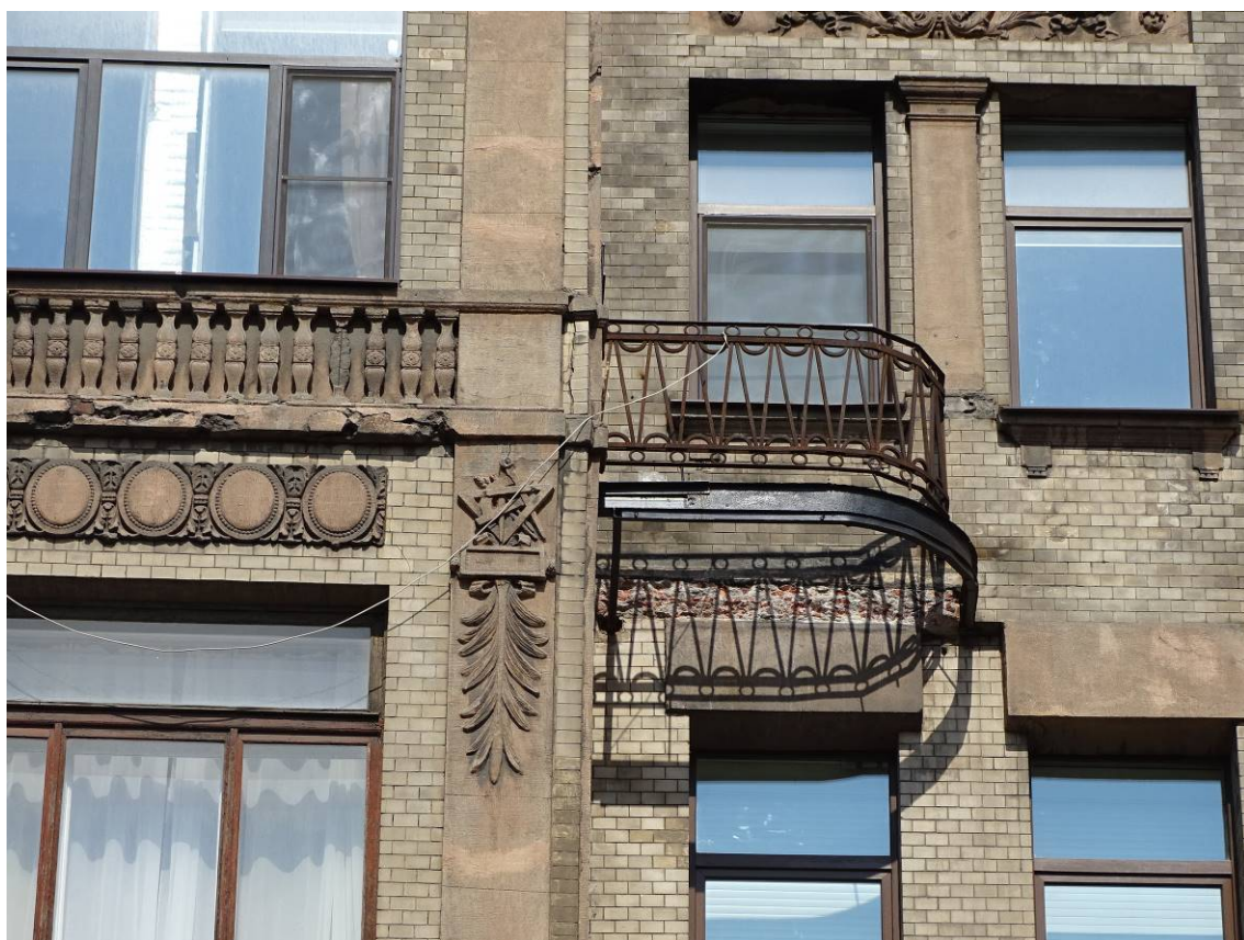
Фото 46. Здание по адресу: г. Санкт-Петербург, Кирочная ул., 22. Фрагмент лицевого фасада. Боковой балкон. Съемка 26.04.2021 г. Трушковский В.Э.
