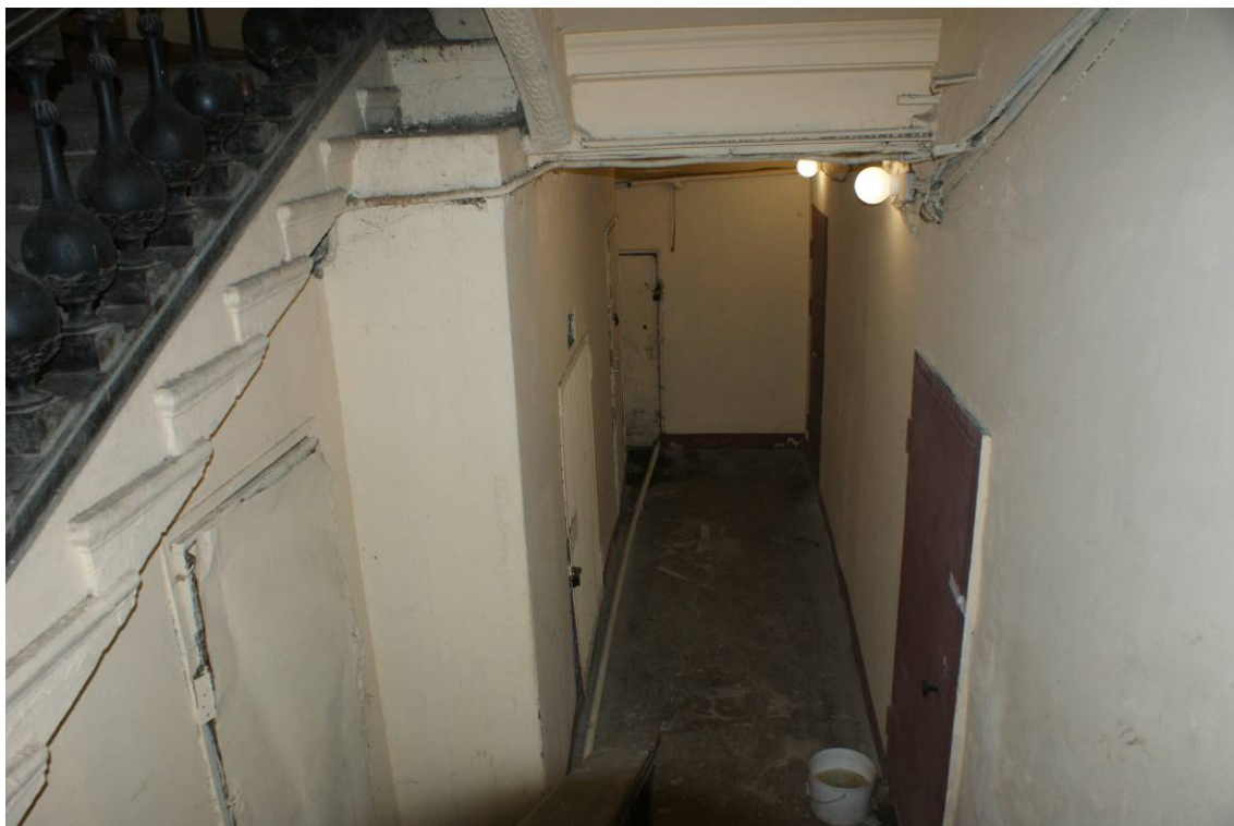
Фото 186. Лестница № 1: Площадка подвального этажа. Съемка 26.04.2021 г. Трушковский В.Э.
