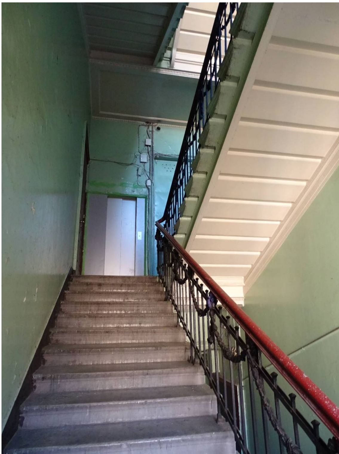
Фото 161. Лестница № 2: Площадка 3-го этажа. Съемка 26.04.2021 г. Трушковский В.Э.
