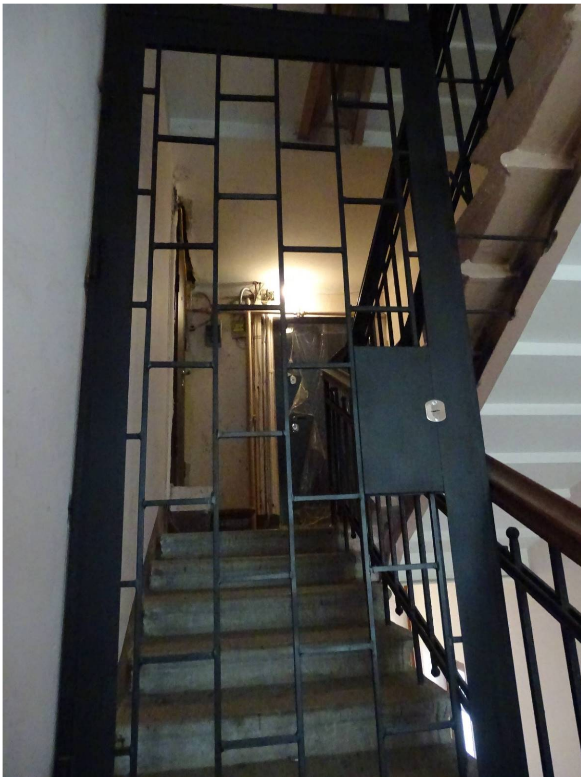
Фото 281. Лестница № 6: Вид на площадку 7-го этажа. Съемка 26.04.2021 г. Трушковский В.Э.
