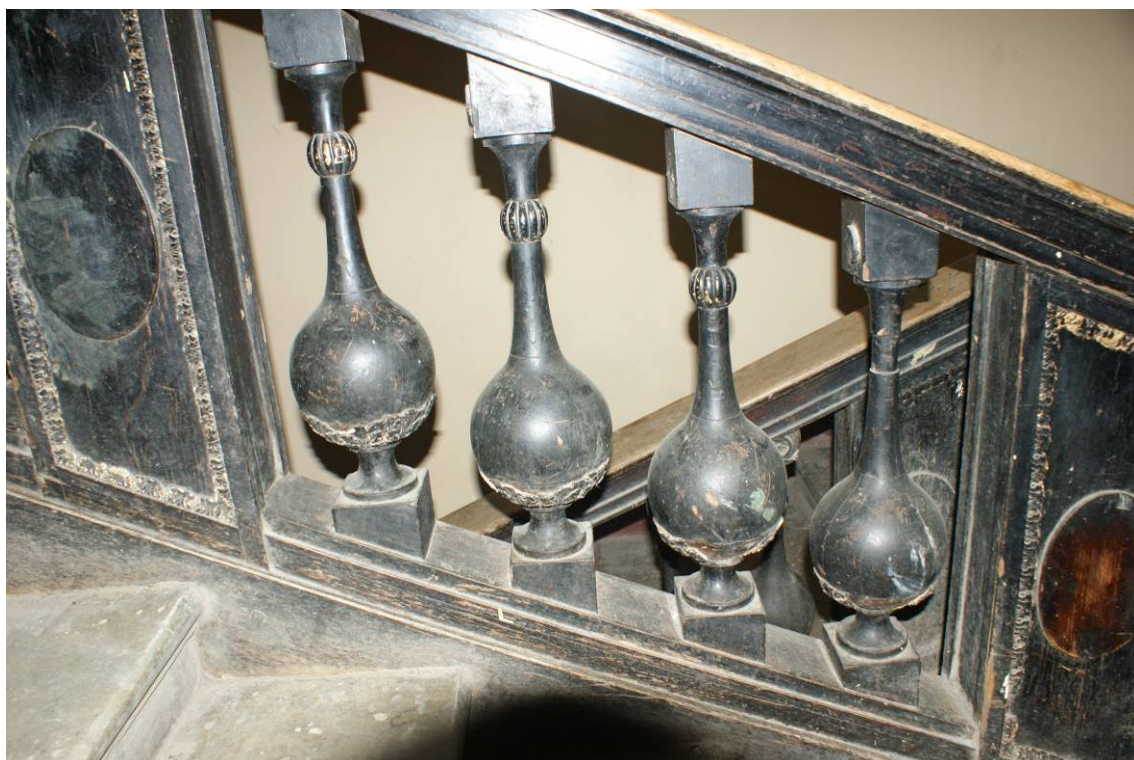
Фото 191. Лестница № 1: Фрагмент лестничного ограждения. Съемка 26.04.2021 г. Трушковский В.Э.
