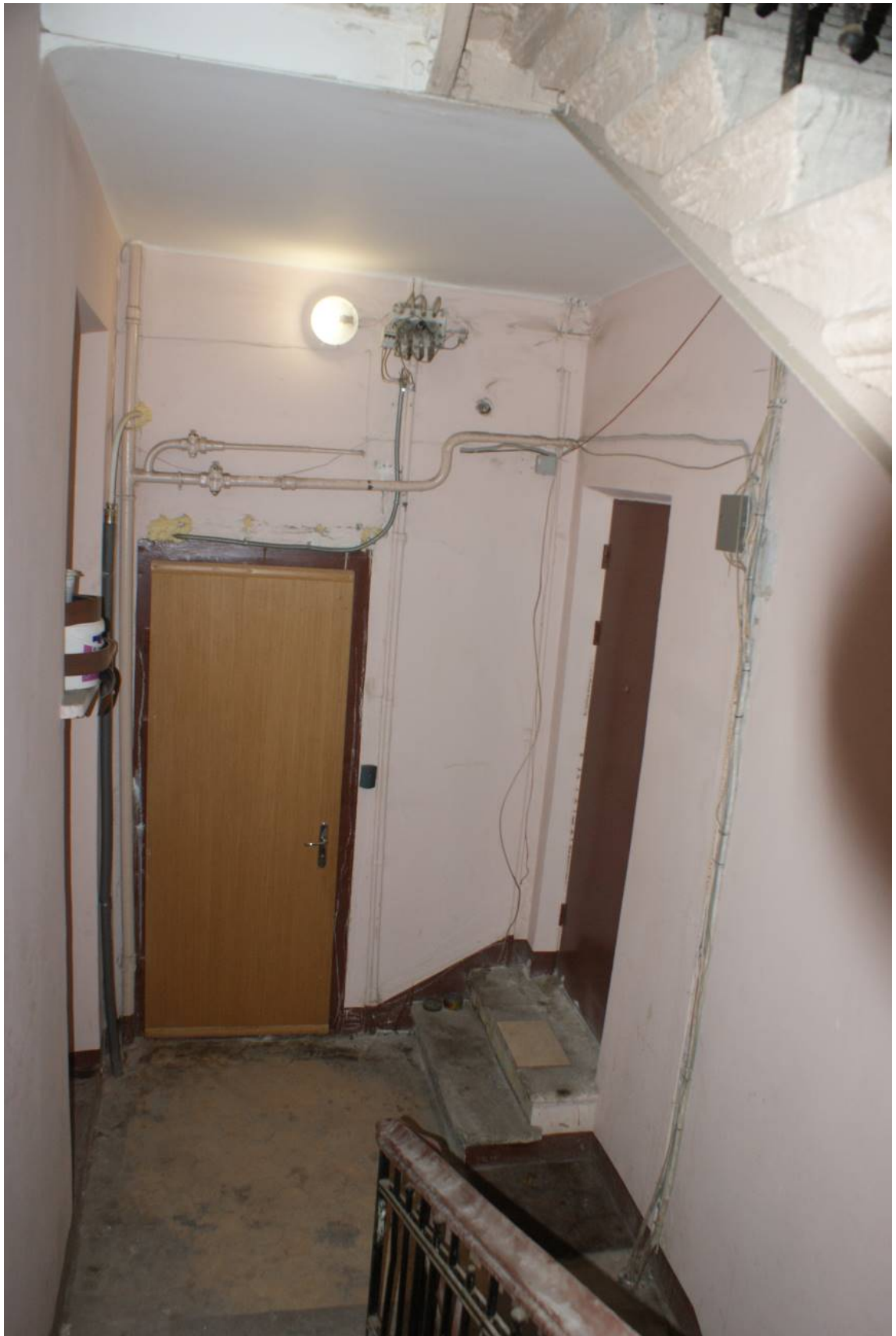
Фото 241. Лестница № 3: Площадка 5-го этажа. Съемка 26.04.2021 г. Трушковский В.Э.
