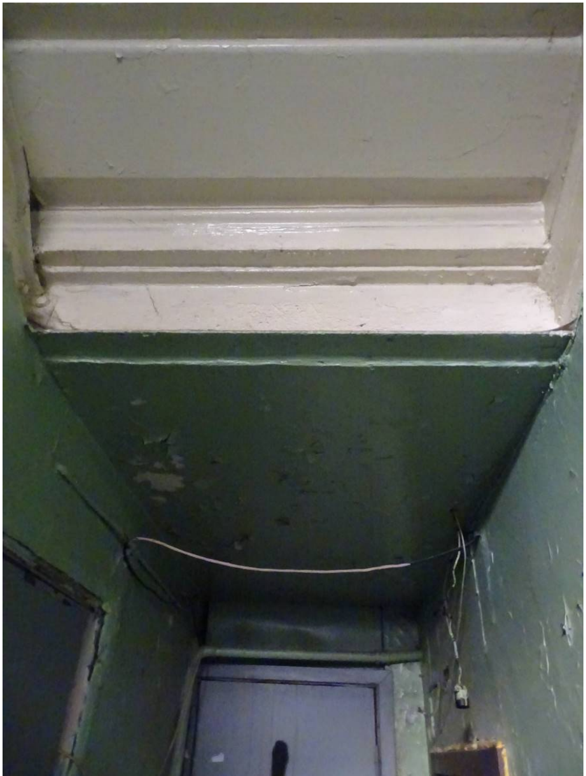
Фото 150. Лестница № 2: Площадка подвального этажа. 1-й этаж. Съемка 26.04.2021 г. Трушковский В.Э.
