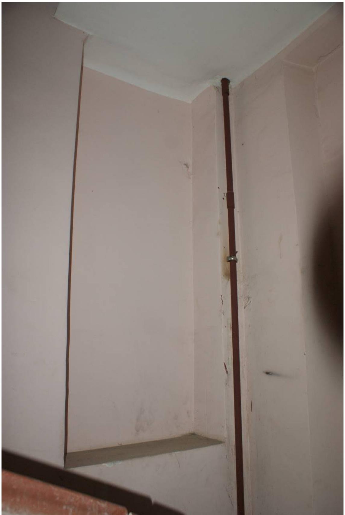
Фото 248. Лестница № 3: Площадка между 6-м и 7-м этажом. Ниша в стене. Съемка 26.04.2021 г. Трушковский В.Э.
