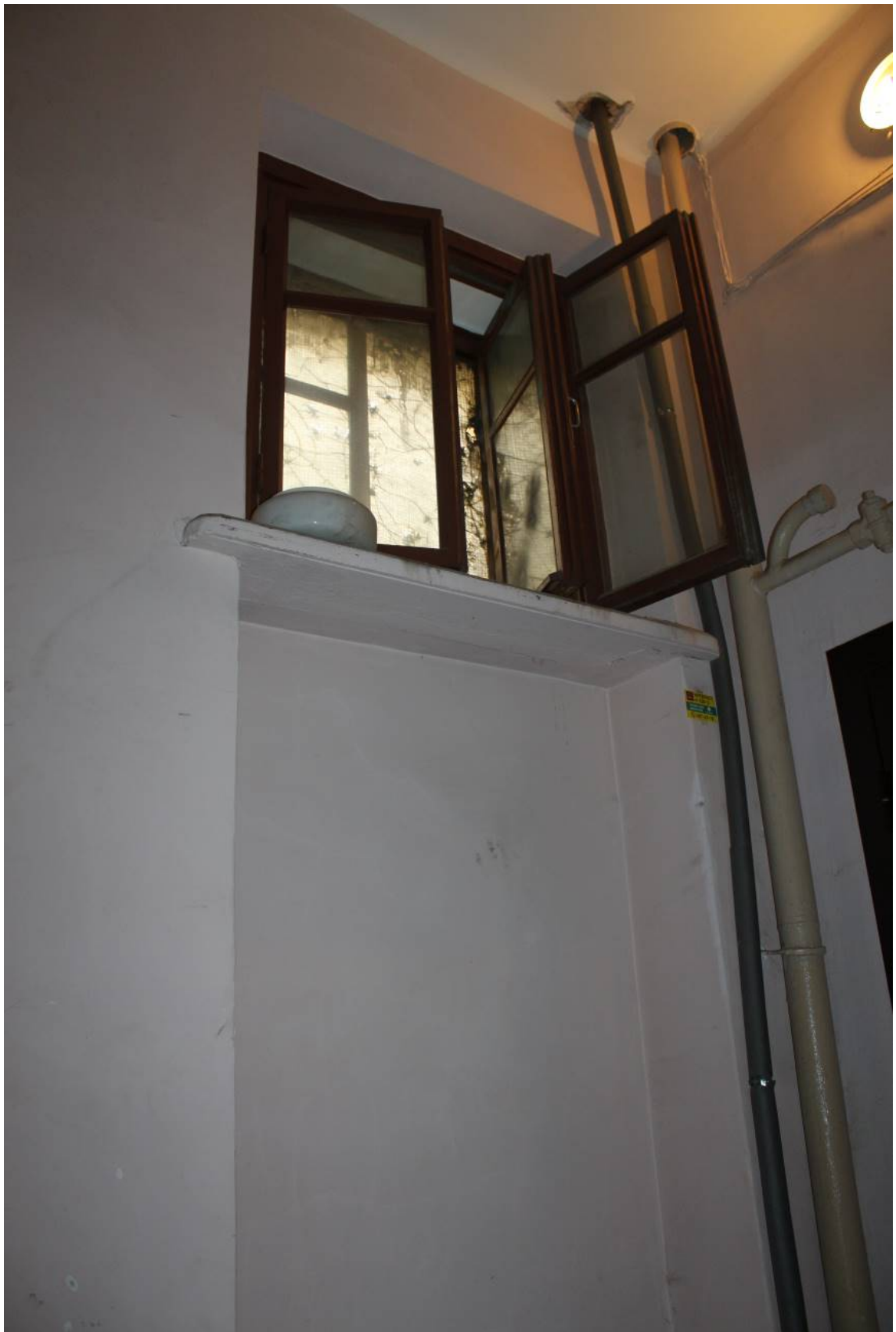
Фото 235. Лестница № 3: Площадка 3-го этажа. Съемка 26.04.2021 г. Трушковский В.Э.
