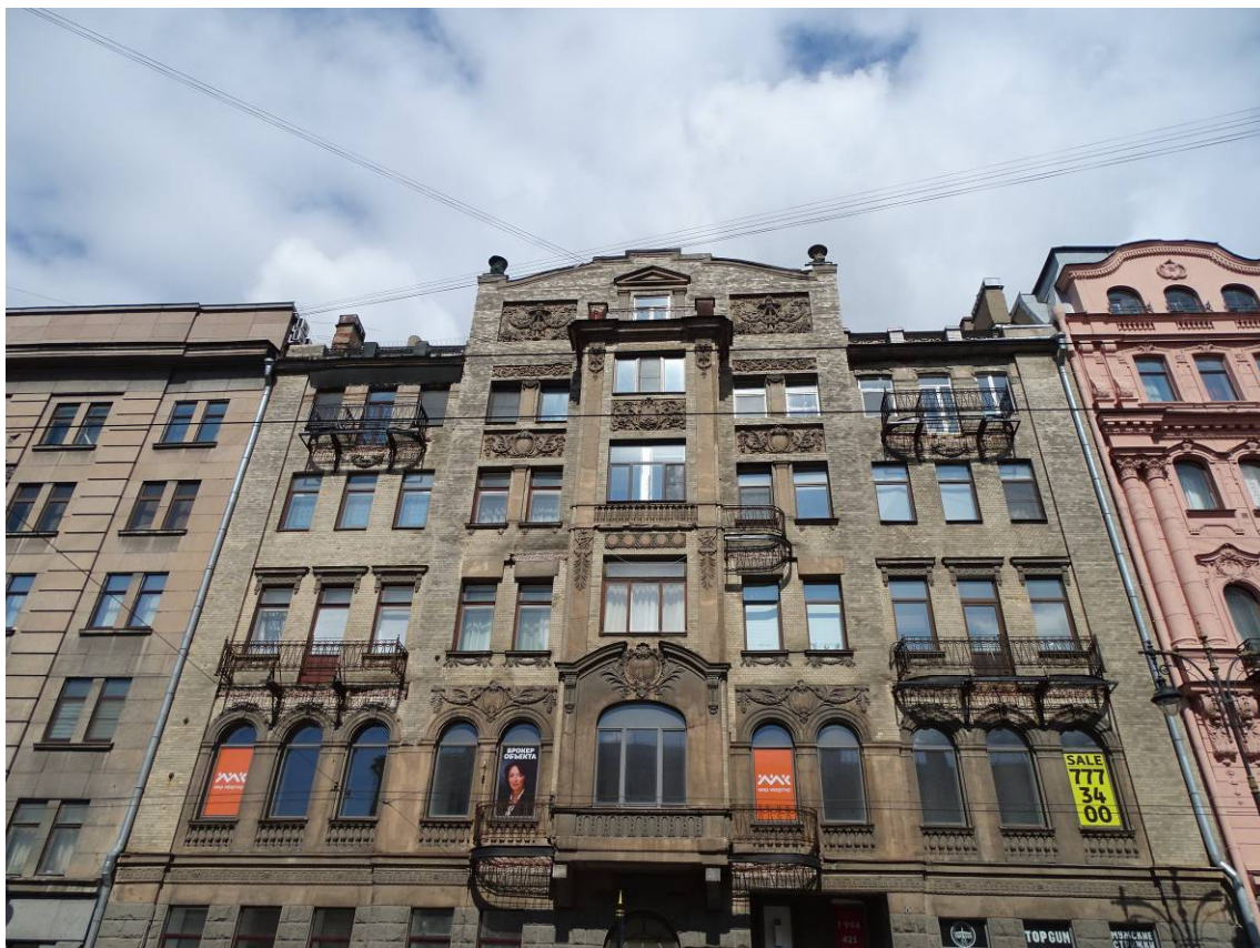
Фото 38. Здание по адресу: г. Санкт-Петербург, Кирочная ул., 22. Фасад с ул. Кирочной. Съемка 26.04.2021 г. Трушковский В.Э.
