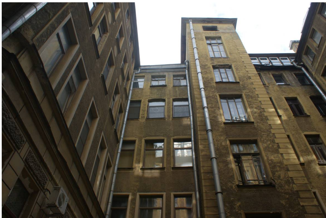
Фото 54. Здание по адресу: г. Санкт-Петербург, Кирочная ул., 22. Фрагмент южного фасада южного внутреннего двора. 3-й, 4-й, 5-й этажи. Съемка 26.04.2021 г. Трушковский В.Э.
