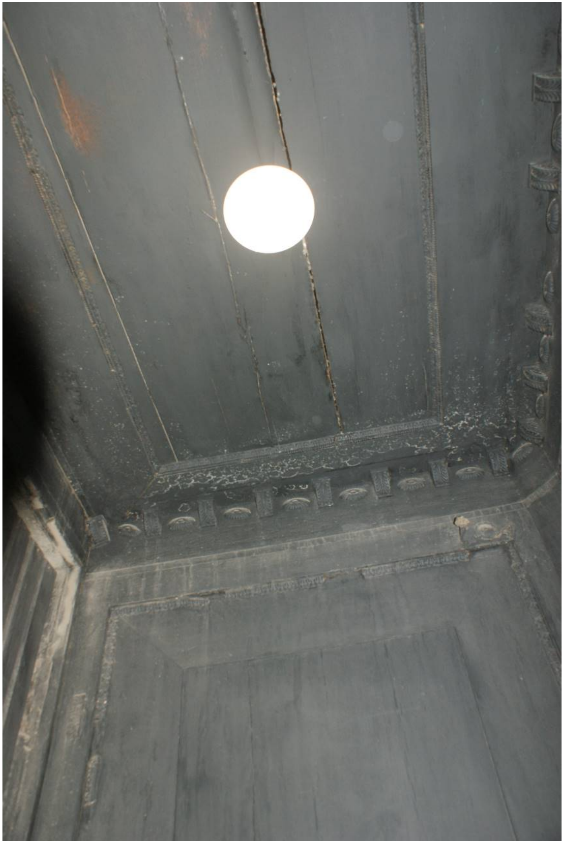
Фото 177. Лестница № 1: 1 этаж. Тамбур. Оформление потолка и стен. Съемка 26.04.2021 г. Трушковский В.Э.
