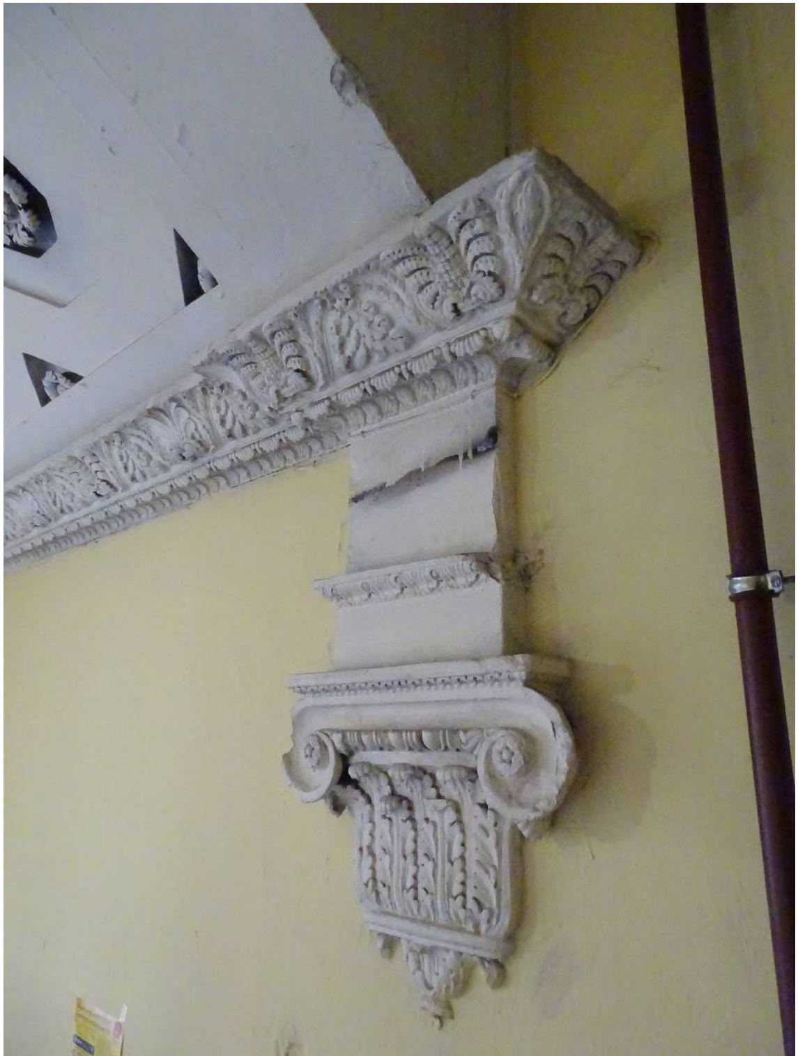
Фото 212. Лестница № 1: Площадка между 4-м и 5-м этажом. Декоративное оформление стен. Фрагмент. Съемка 26.04.2021 г. Трушковский В.Э.
