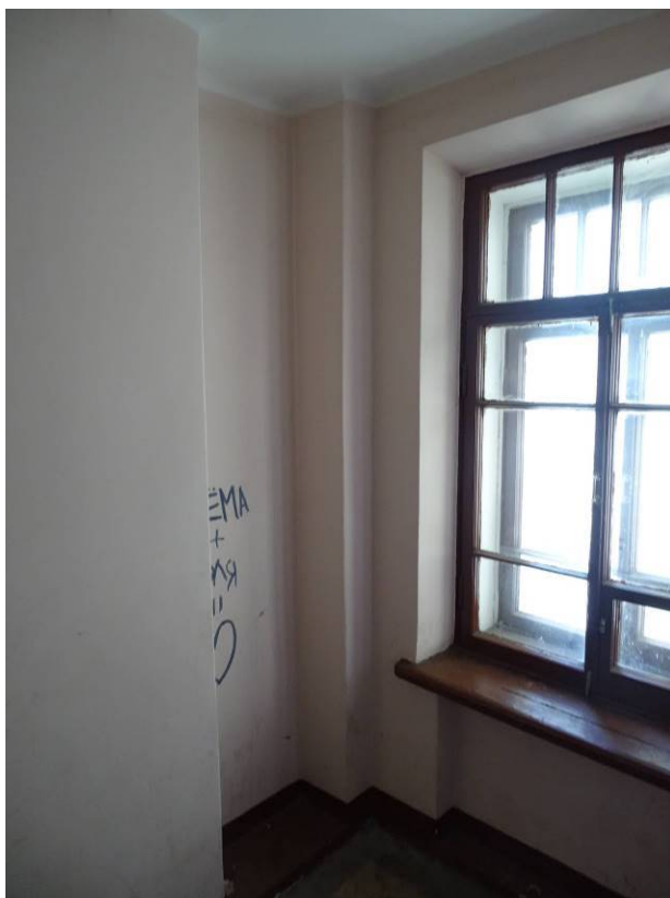
Фото 279. Лестница № 6: Площадка между 6-м и 7-м этажом. Ниша в стене. Съемка 26.04.2021 г. Трушковский В.Э.
