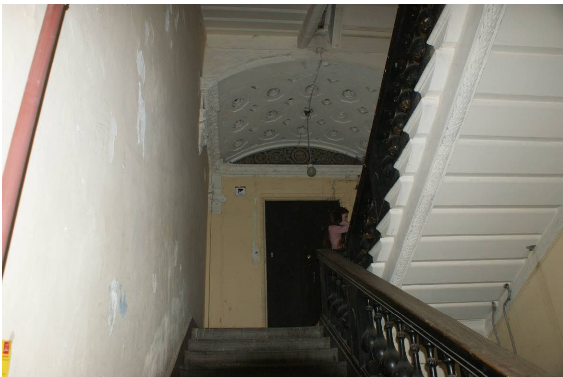
Фото 201. Лестница № 1: Площадка 3-го этажа. Съемка 26.04.2021 г. Трушковский В.Э.
