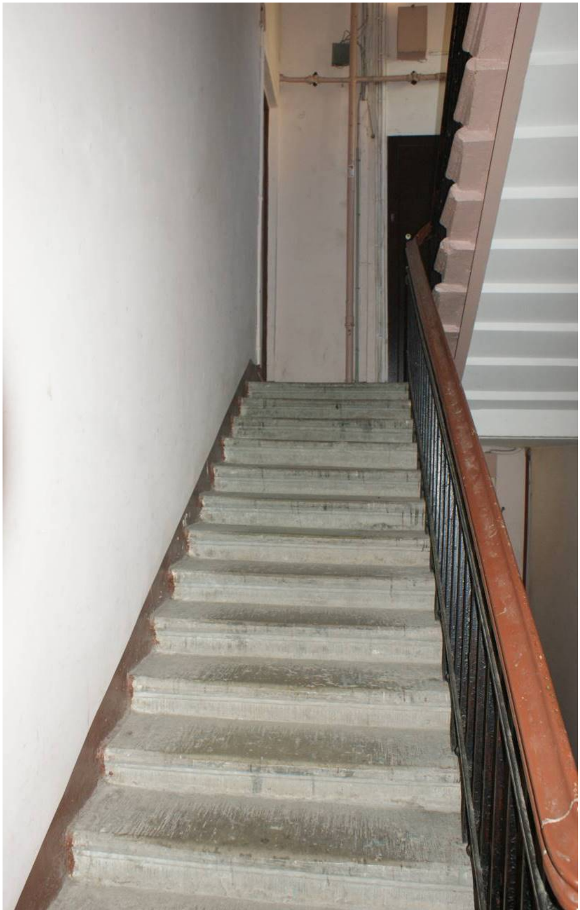
Фото 260. Лестница № 6: Лестничный марш на площадку 3-го этажа. Съемка 26.04.2021 г. Трушковский В.Э.
