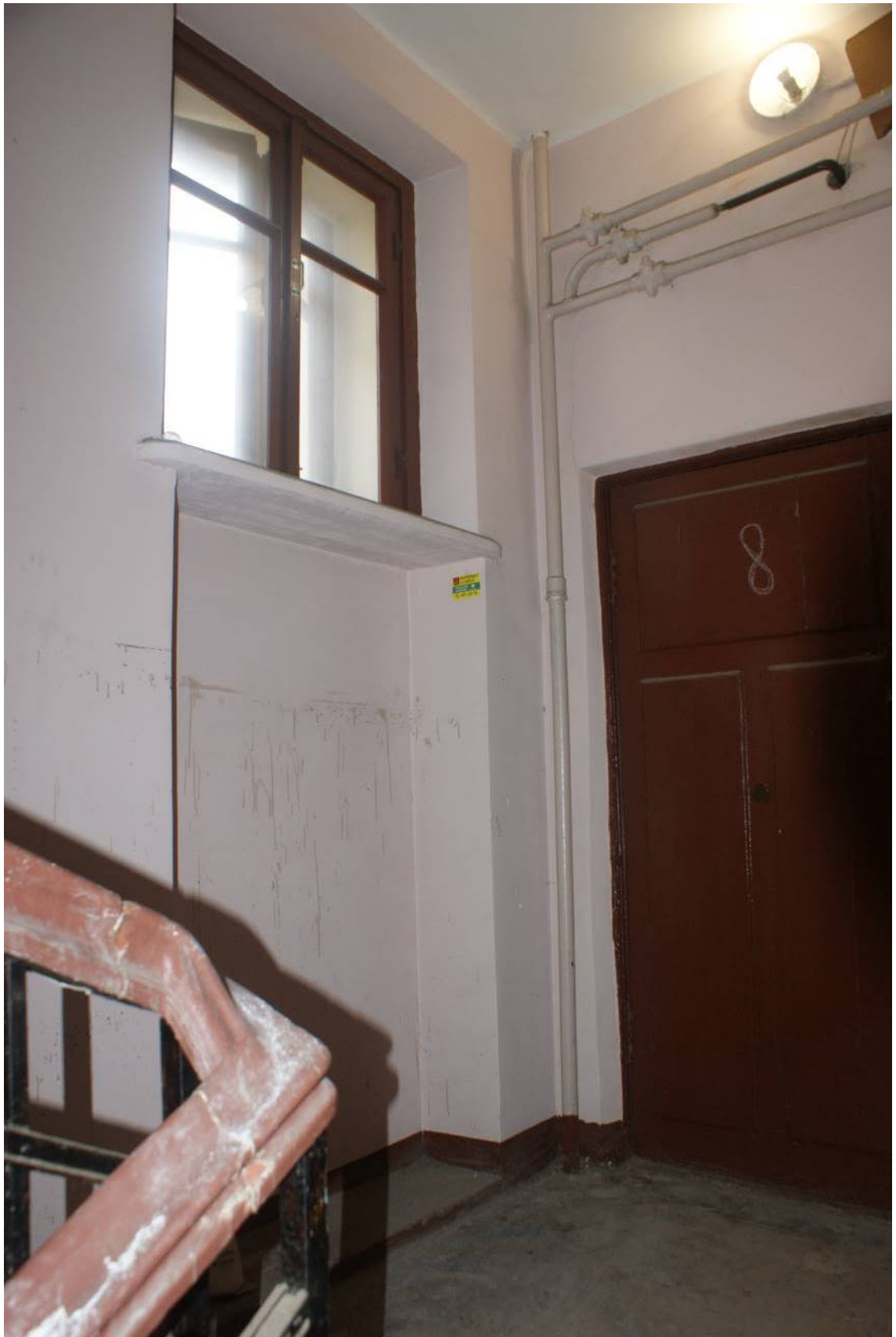
Фото 246. Лестница № 3: Площадка 6-го этажа. Съемка 26.04.2021 г. Трушковский В.Э.
