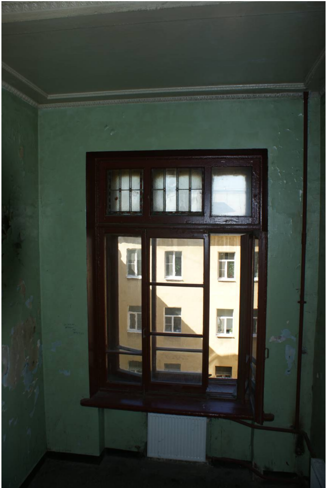
Фото 164. Лестница № 2: Площадка между 3-м и 4-м этажом. Оформление окна. Съемка 26.04.2021 г. Трушковский В.Э.
