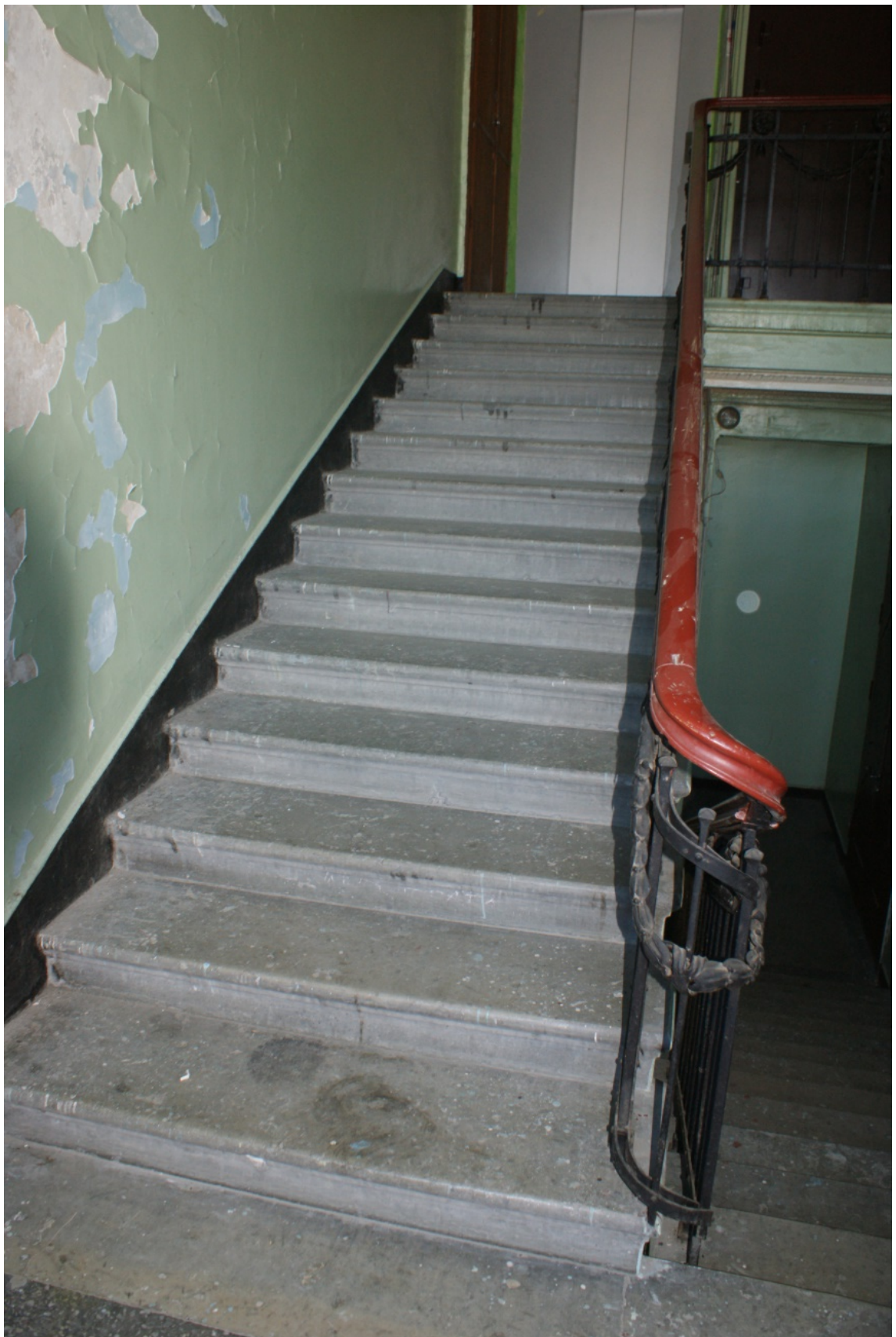
Фото 172. Лестница № 2: Лестничный марш на 6-й этаж. Съемка 26.04.2021 г. Трушковский В.Э.
