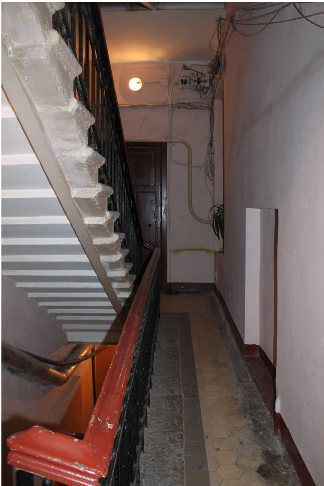
Фото 227. Лестница № 3: 2 этаж. Съемка 26.04.2021 г. Трушковский В.Э.
