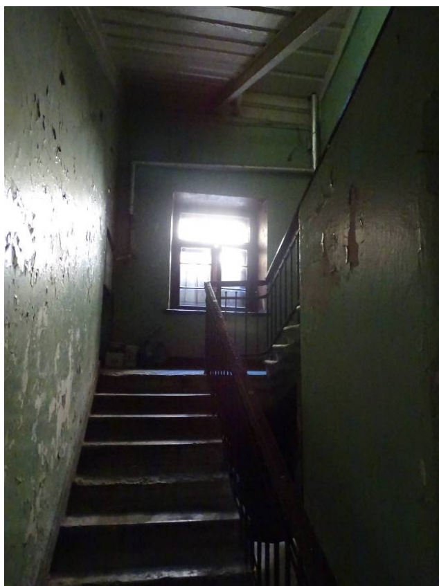
Фото 151. Лестница № 2: Площадка между подвальным и 1-м этажом. Съемка 26.04.2021 г. Трушковский В.Э.
