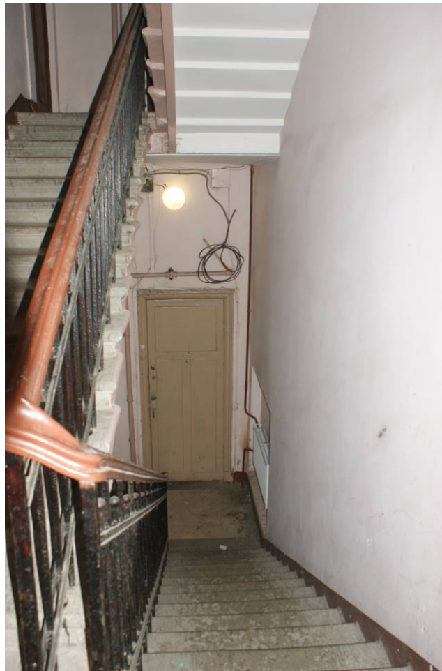
Фото 256. Лестница № 6: Площадка 2-го этажа. Съемка 26.04.2021 г. Трушковский В.Э.
