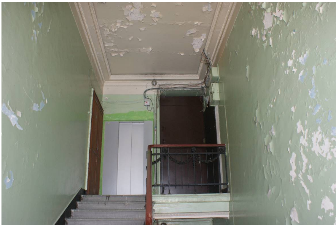
Фото 173. Лестница № 2: Площадка 6-го этажа. Съемка 26.04.2021 г. Трушковский В.Э.
