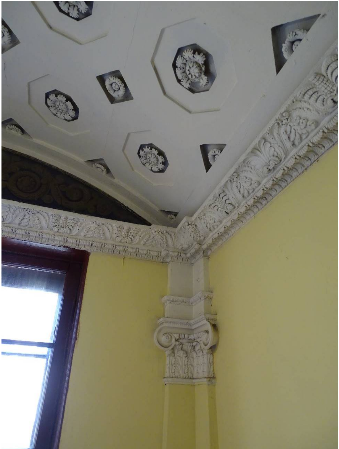
Фото 213. Лестница № 1: Площадка между 4-м и 5-м этажом. Декоративное оформление стен. Съемка 26.04.2021 г. Трушковский В.Э.
