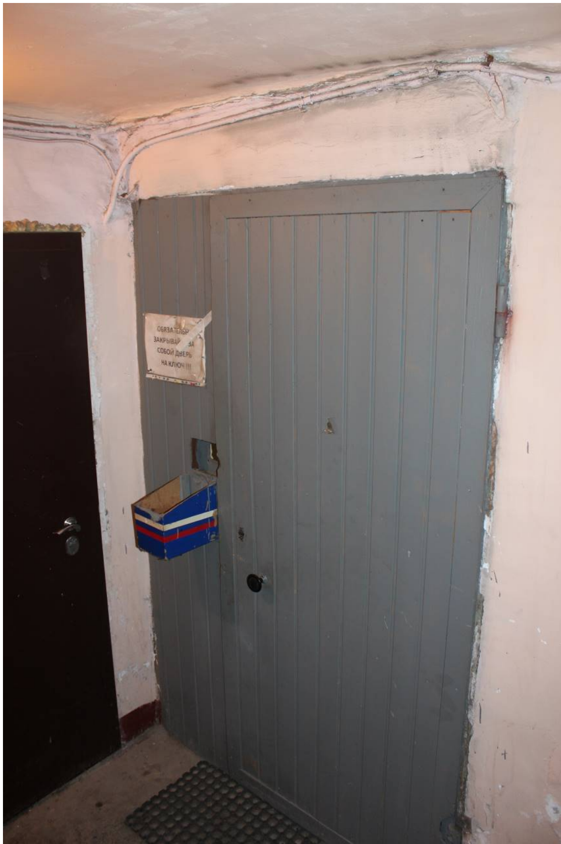
Фото 222. Лестница № 3: 1-й этаж Входная дверь. Съемка 26.04.2021 г. Трушковский В.Э.
