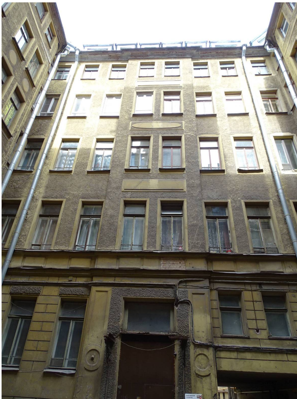
Фото 62. Здание по адресу: г. Санкт-Петербург, Кирочная ул., 22. Северный фасад южного внутреннего двора. Съемка 26.04.2021 г. Трушковский В.Э.
