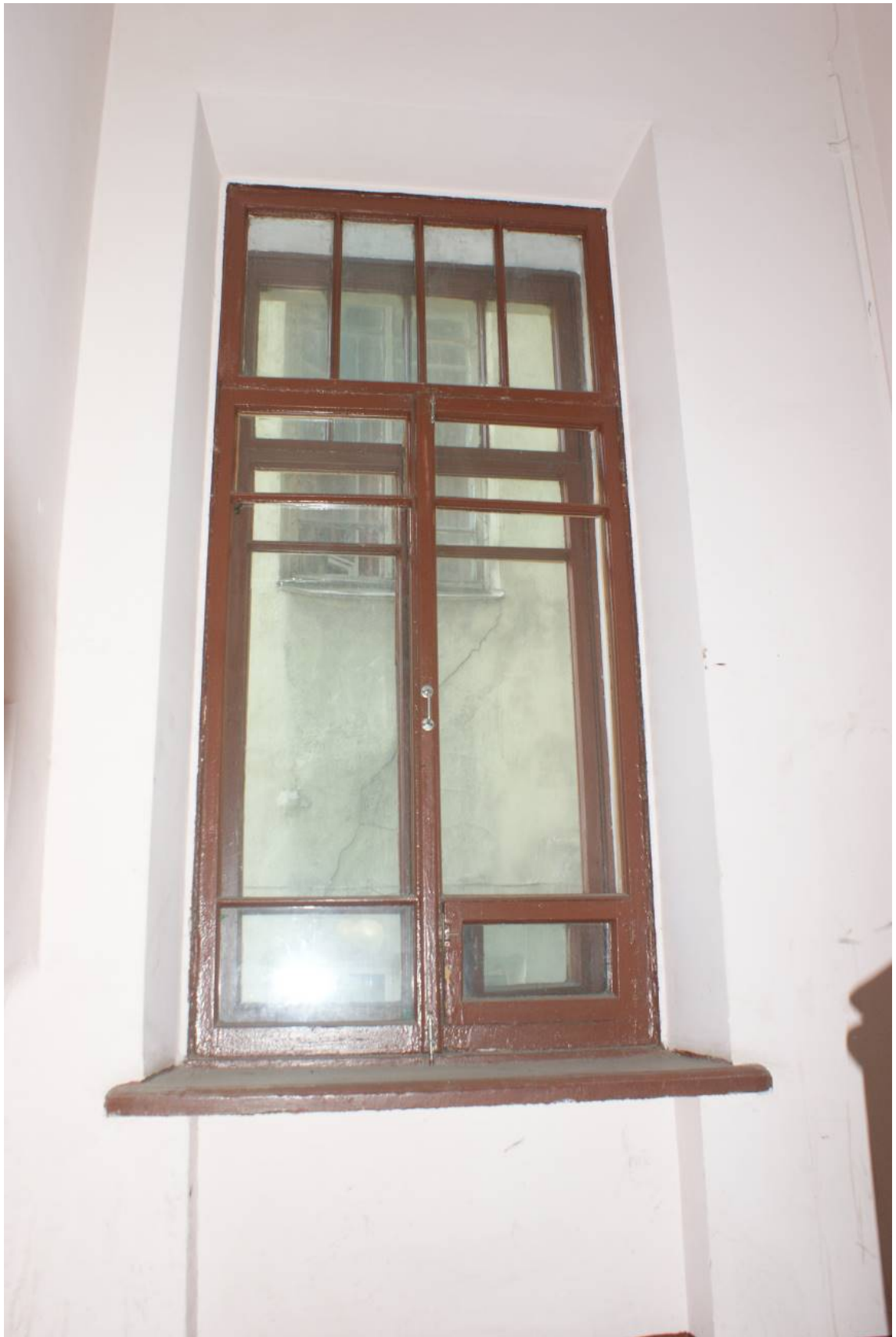
Фото 259. Лестница № 6: Площадка между 2-м и 3-м этажом. Оформление окна. Съемка 26.04.2021 г. Трушковский В.Э.
