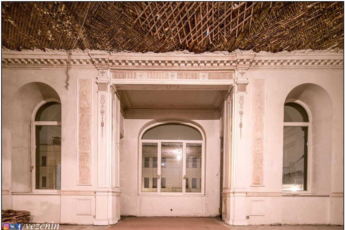
29. Интерьер квартиры А. П. Мещерского: парадный зал. (после пожара на верхних этажах пострадал потолок). Фото из открытых источников.
