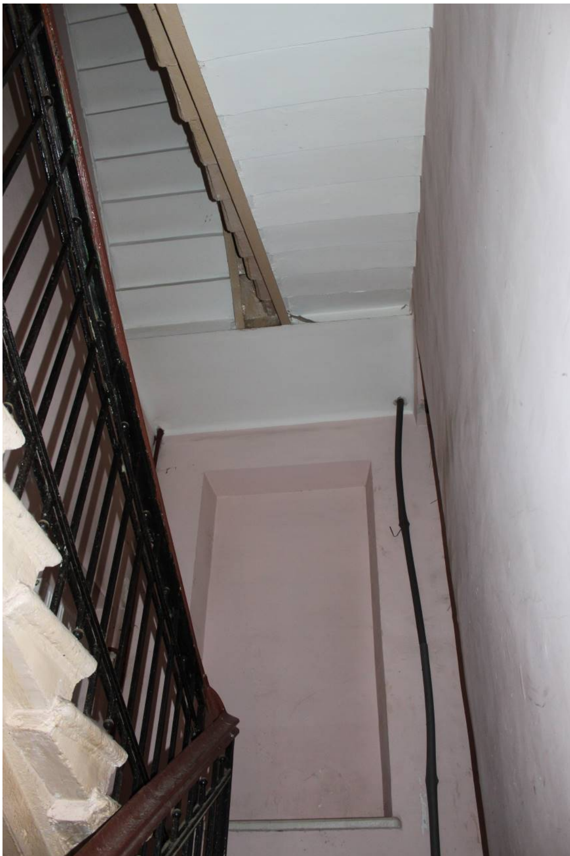
Фото 230. Лестница № 3: Площадка м/у 2-м и 3-м этажом. Съемка 26.04.2021 г. Трушковский В.Э.
