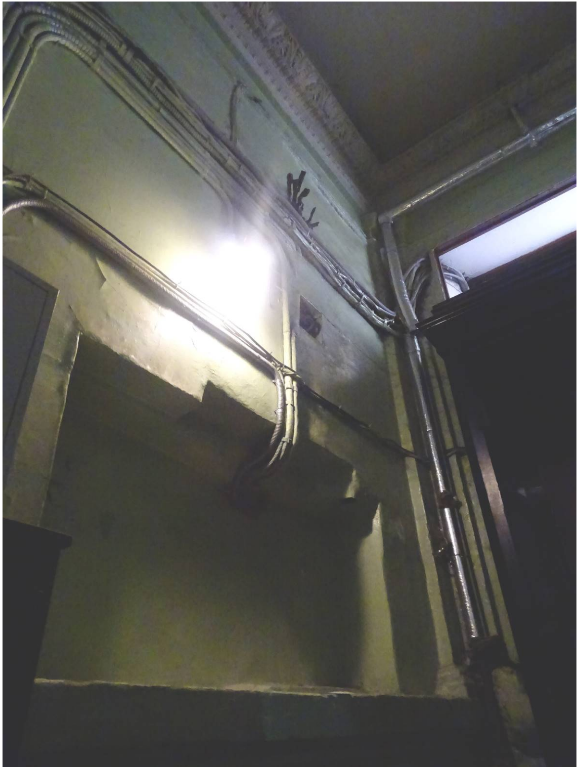
Фото 143. Лестница № 2: Вестибюль. 1-й этаж. Ниша в стене. Съемка 26.04.2021 г. Трушковский В.Э.
