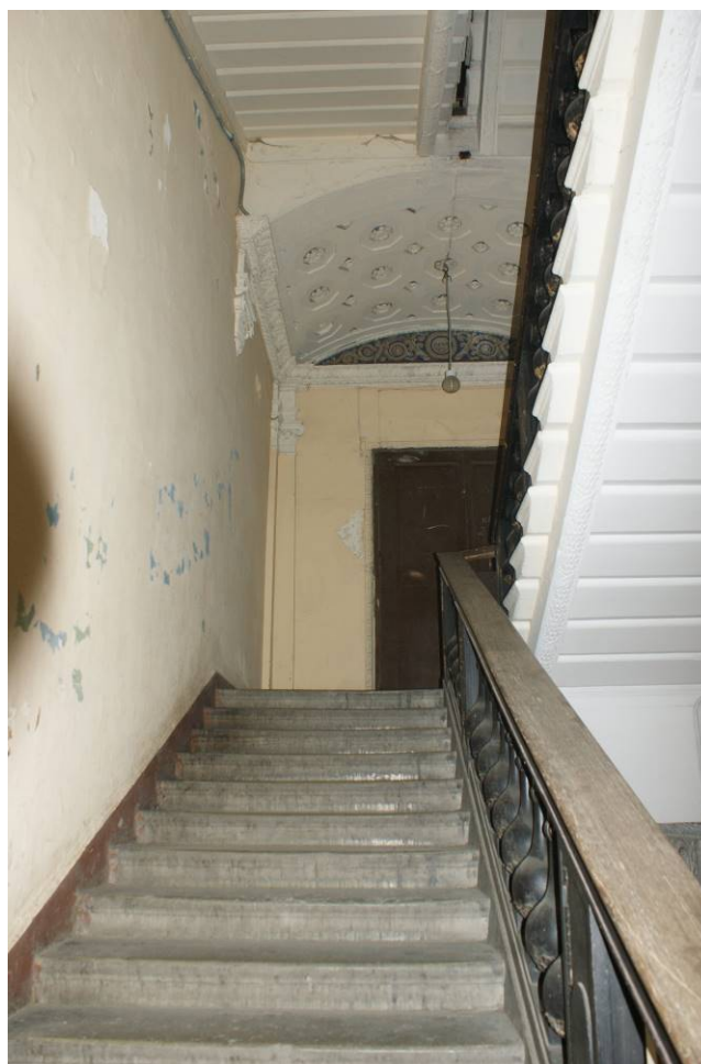
Фото 195. Лестница № 1: Площадка 2-го этажа. Съемка 26.04.2021 г. Трушковский В.Э.
