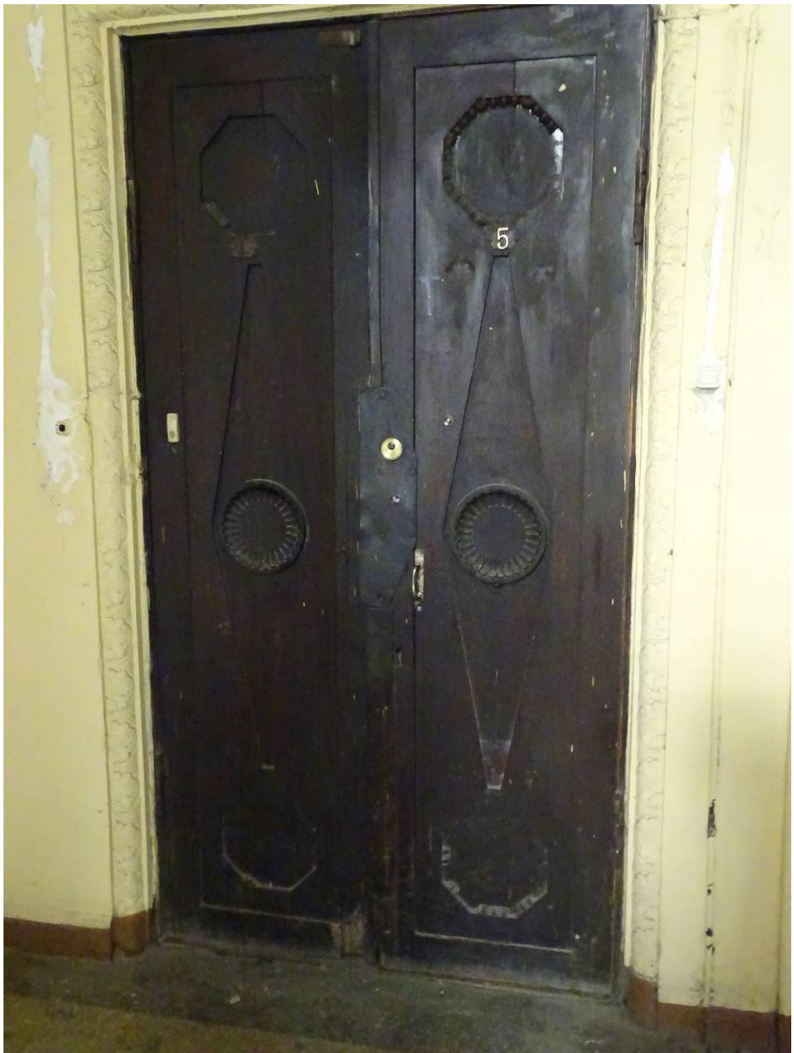
Фото 202. Лестница № 1: Площадка 3-го этажа. Оформление двери. Съемка 26.04.2021 г. Трушковский В.Э.
