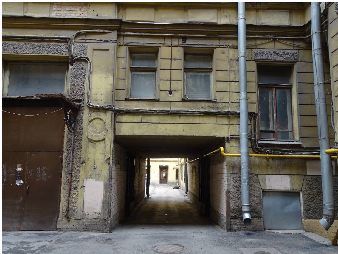
Фото 64. Здание по адресу: г. Санкт-Петербург, Кирочная ул., 22. Фрагмент северного фасада южного внутреннего двора. Воротный проезд. Съемка 26.04.2021 г. Трушковский В.Э.
