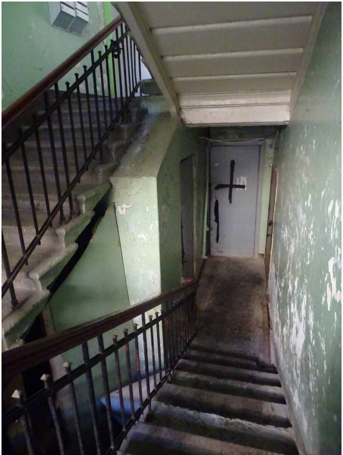
Фото 149. Лестница № 2: Площадка подвального этажа. 1-й этаж. Съемка 26.04.2021 г. Трушковский В.Э.
