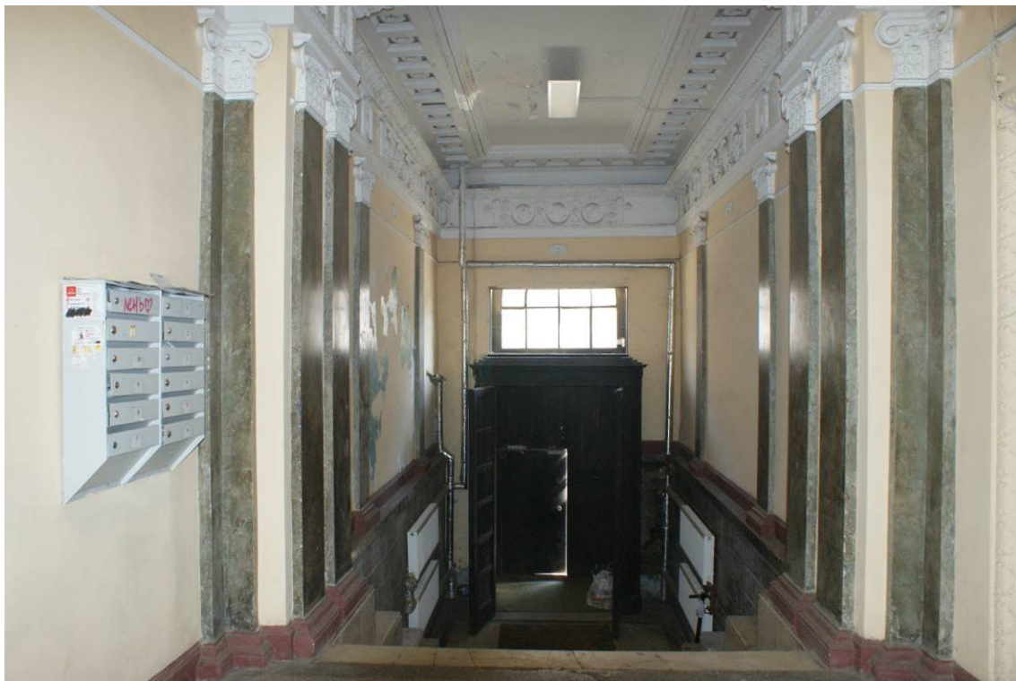
Фото 175. Лестница № 1: Вестибюль. Входная дверь. Съемка 26.04.2021 г. Трушковский В.Э.
