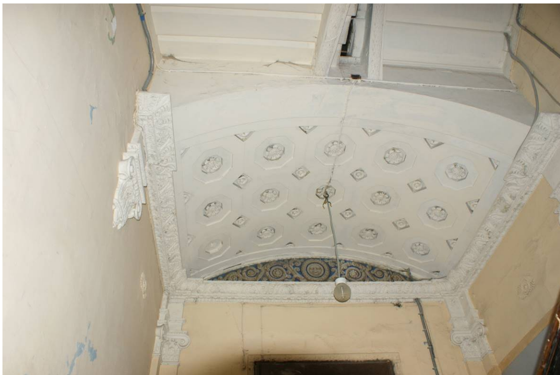
Фото 196. Лестница № 1: Площадка 2-го этажа. Оформление плафонов перекрытия. Съемка 26.04.2021 г. Трушковский В.Э.
