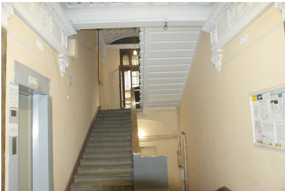
Фото 188. Лестница № 1: Площадка 1-го этажа. Съемка 26.04.2021 г. Трушковский В.Э.
