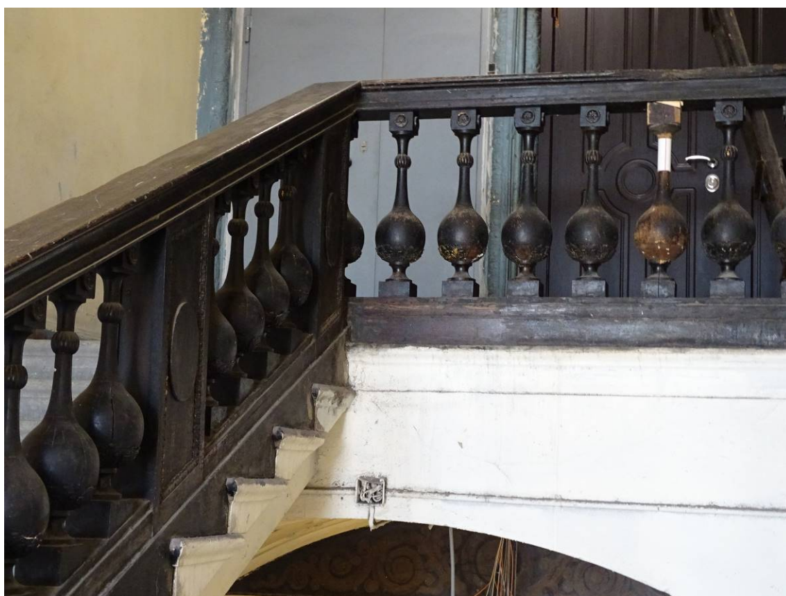
Фото 220. Лестница № 1: Площадка 6-го этажа. Фрагмент лестничного ограждения. Съемка 26.04.2021 г. Трушковский В.Э.
