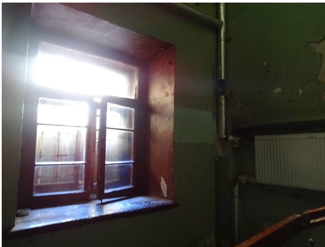
Фото 152. Лестница № 2: Площадка между подвальным и 1-м этажом. Съемка 26.04.2021 г. Трушковский В.Э.
