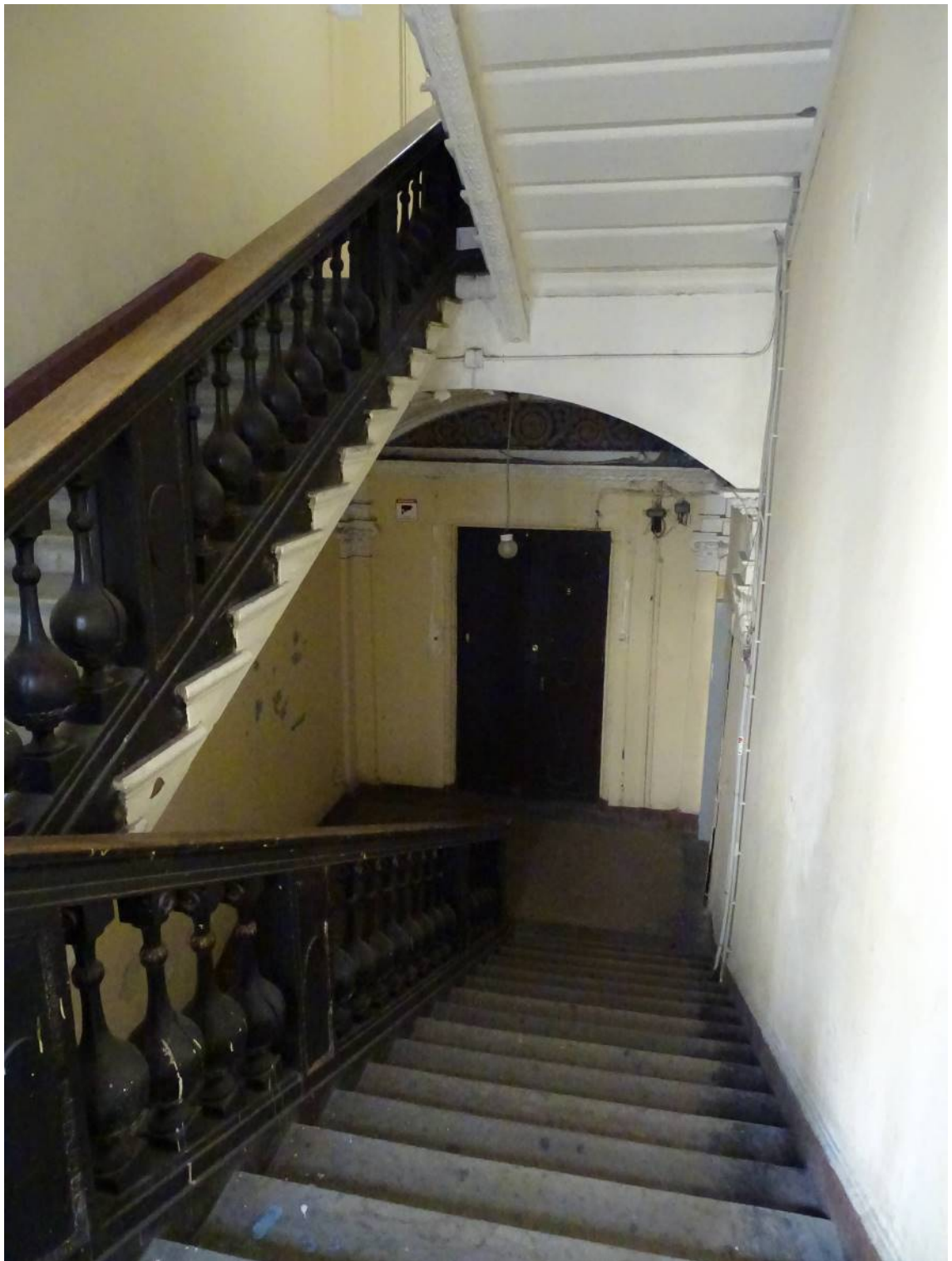
Фото 203. Лестница № 1: Площадка 3-го этажа. Съемка 26.04.2021 г. Трушковский В.Э.
