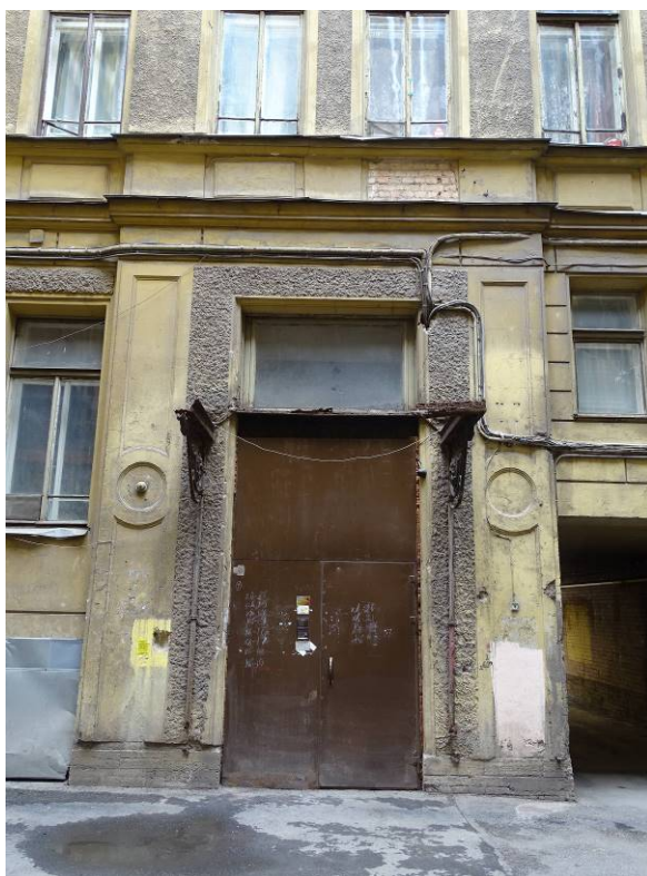
Фото 63. Здание по адресу: г. Санкт-Петербург, Кирочная ул., 22. Фрагмент северного фасада южного внутреннего двора. Вход на лестницу №2. Съемка 26.04.2021 г. Трушковский В.Э.
