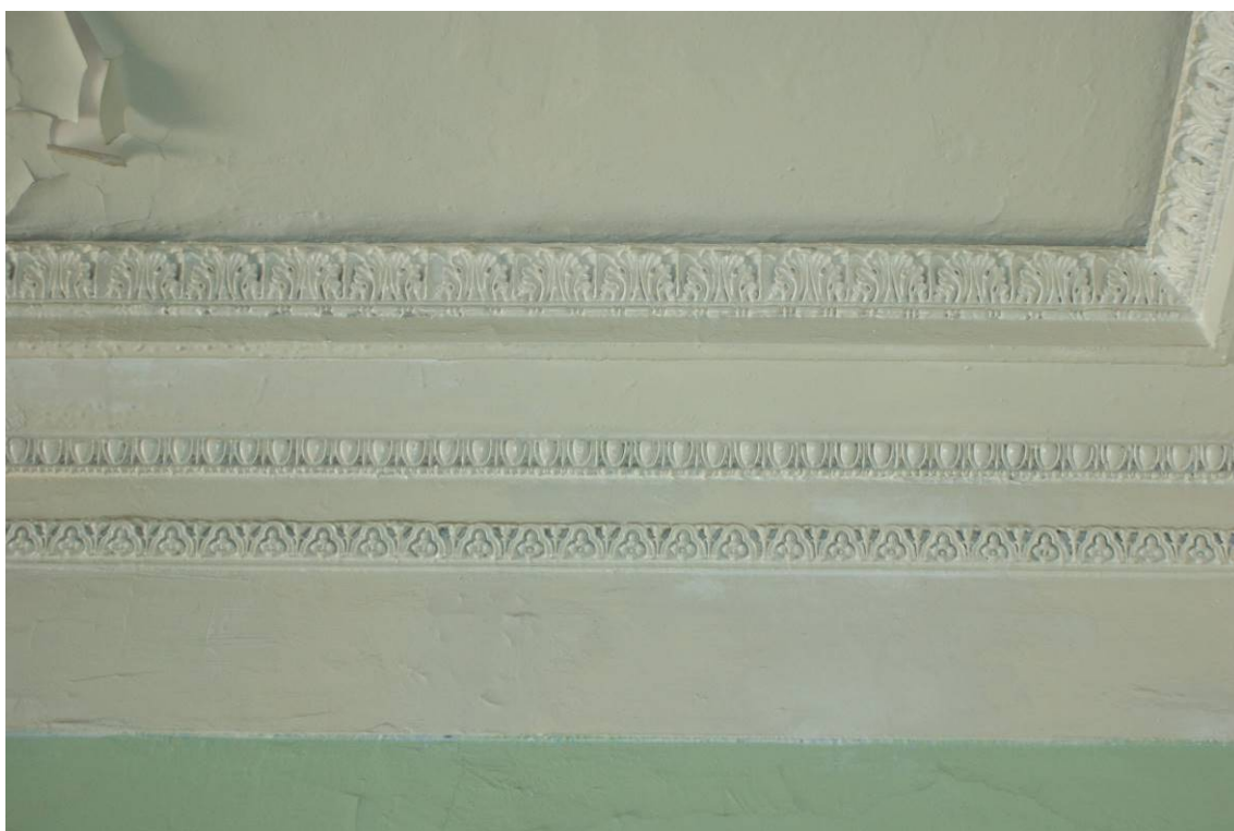
Фото 174. Лестница № 2: Площадка 6-го этажа. Оформление потолка. Съемка 26.04.2021 г. Трушковский В.Э.
