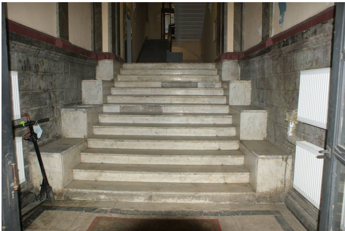
Фото 178. Лестница № 1: Вестибюль. Одномаршевая лестница. Съемка 26.04.2021 г. Трушковский В.Э.
