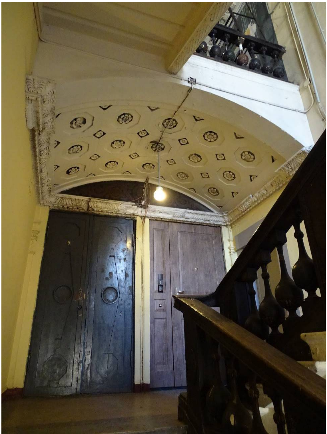
Фото 215. Лестница № 1: Площадка 5-го этажа. Съемка 26.04.2021 г. Трушковский В.Э.
