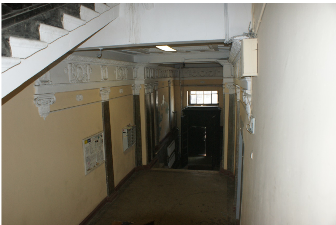
Фото 185. Лестница № 1: Площадка 1-го этажа. Съемка 26.04.2021 г. Трушковский В.Э.
