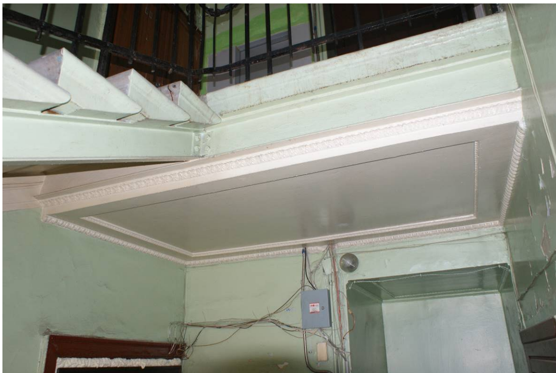
Фото 169. Лестница № 2: Площадка 5-го этажа. Съемка 26.04.2021 г. Трушковский В.Э.
