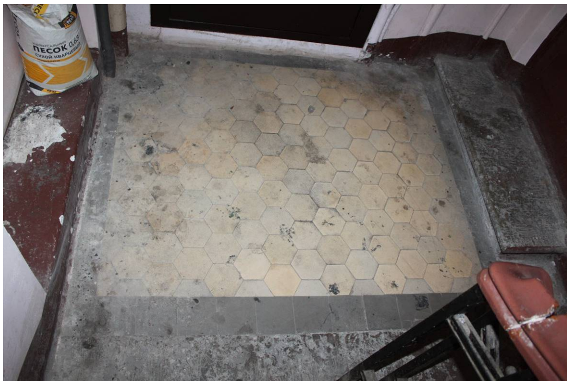
Фото 233. Лестница № 3: Площадка 3-го этажа. Покрытие пола. Съемка 26.04.2021 г. Трушковский В.Э.
