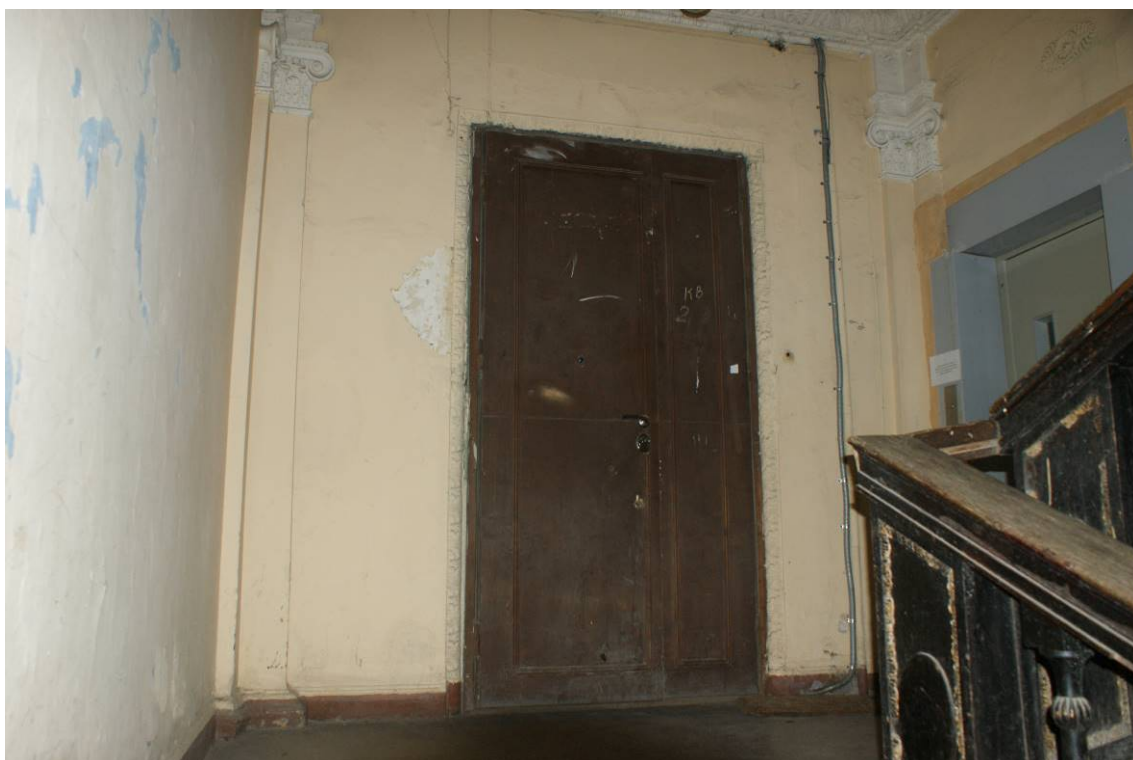
Фото 197. Лестница № 1: Площадка 2-го этажа. Оформление двери. Съемка 26.04.2021 г. Трушковский В.Э.
