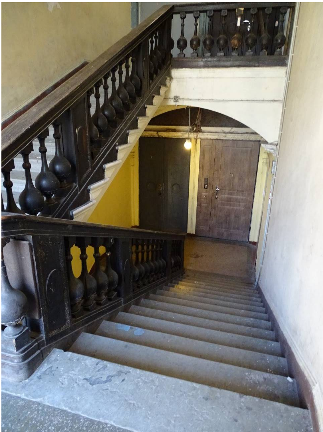
Фото 214. Лестница № 1: Площадка 5-го этажа. Съемка 26.04.2021 г. Трушковский В.Э.
