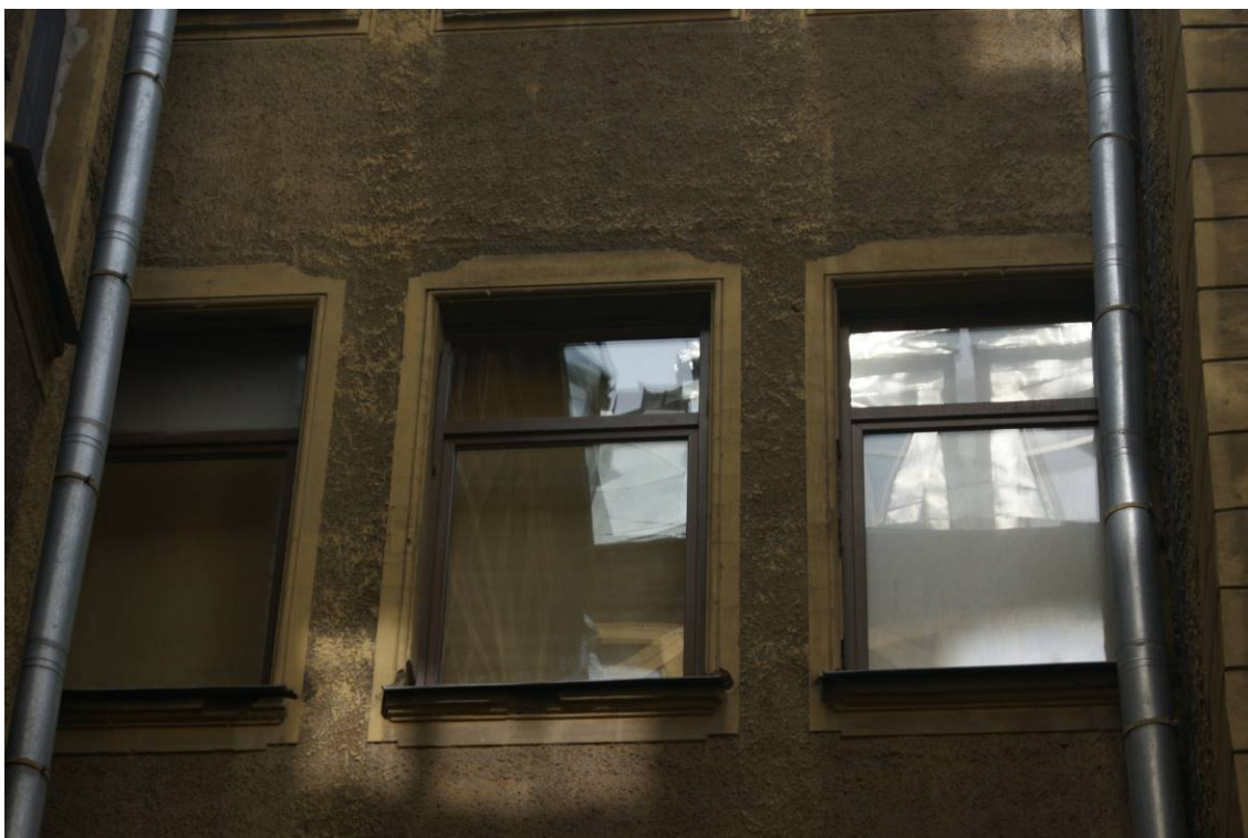
Фото 56. Здание по адресу: г. Санкт-Петербург, Кирочная ул., 22. Фрагмент южного фасада южного внутреннего двора. 3-й этаж. Съемка 26.04.2021 г. Трушковский В.Э.
