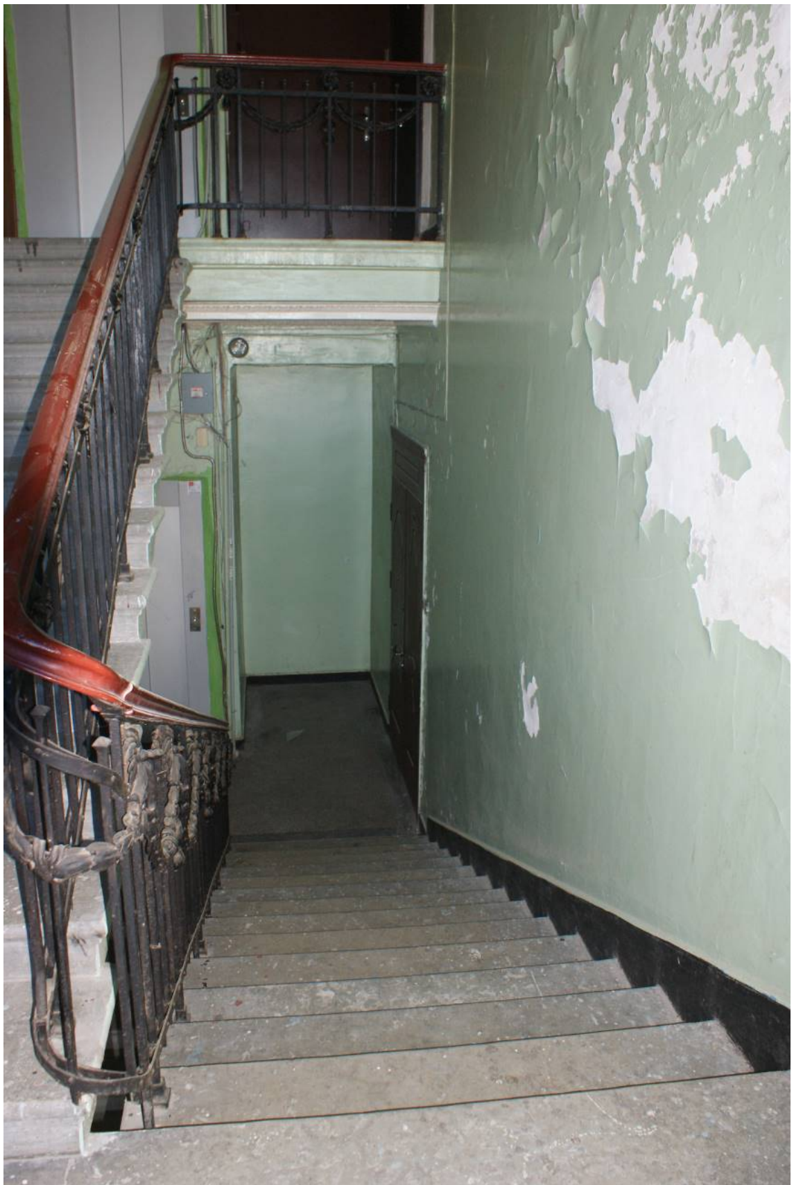
Фото 168. Лестница № 2: Площадка 5-го этажа. Съемка 26.04.2021 г. Трушковский В.Э.
