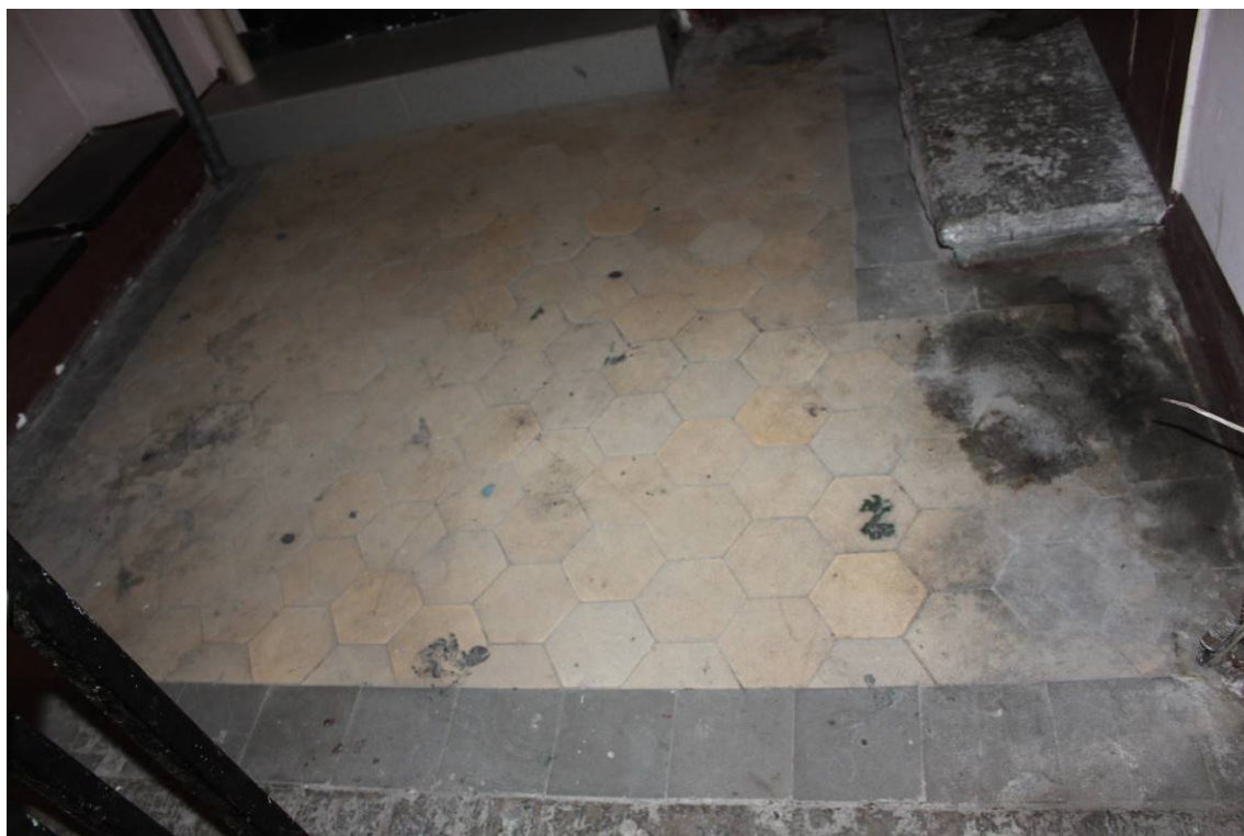
Фото 238. Лестница № 3: Площадка 4-го этажа. Покрытие пола. Съемка 26.04.2021 г. Трушковский В.Э.
