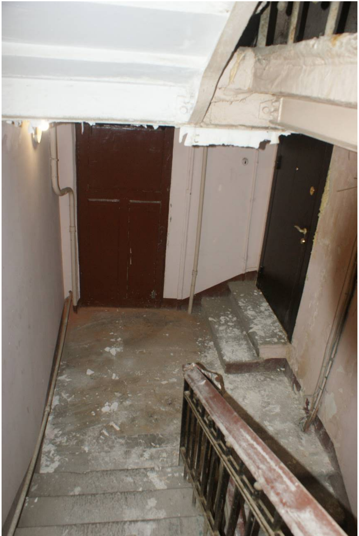
Фото 249. Лестница № 3: Площадка 7-го этажа. Съемка 26.04.2021 г. Трушковский В.Э.
