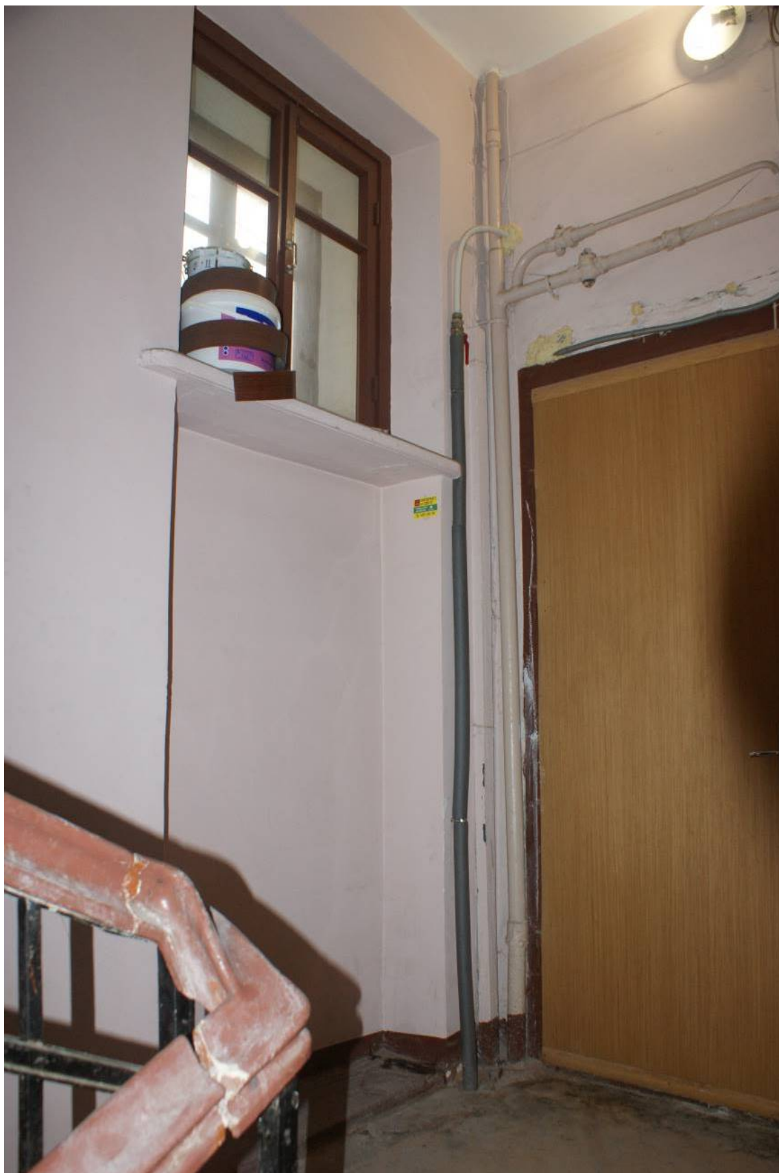
Фото 242. Лестница № 3: Площадка 5-го этажа. Съемка 26.04.2021 г. Трушковский В.Э.
