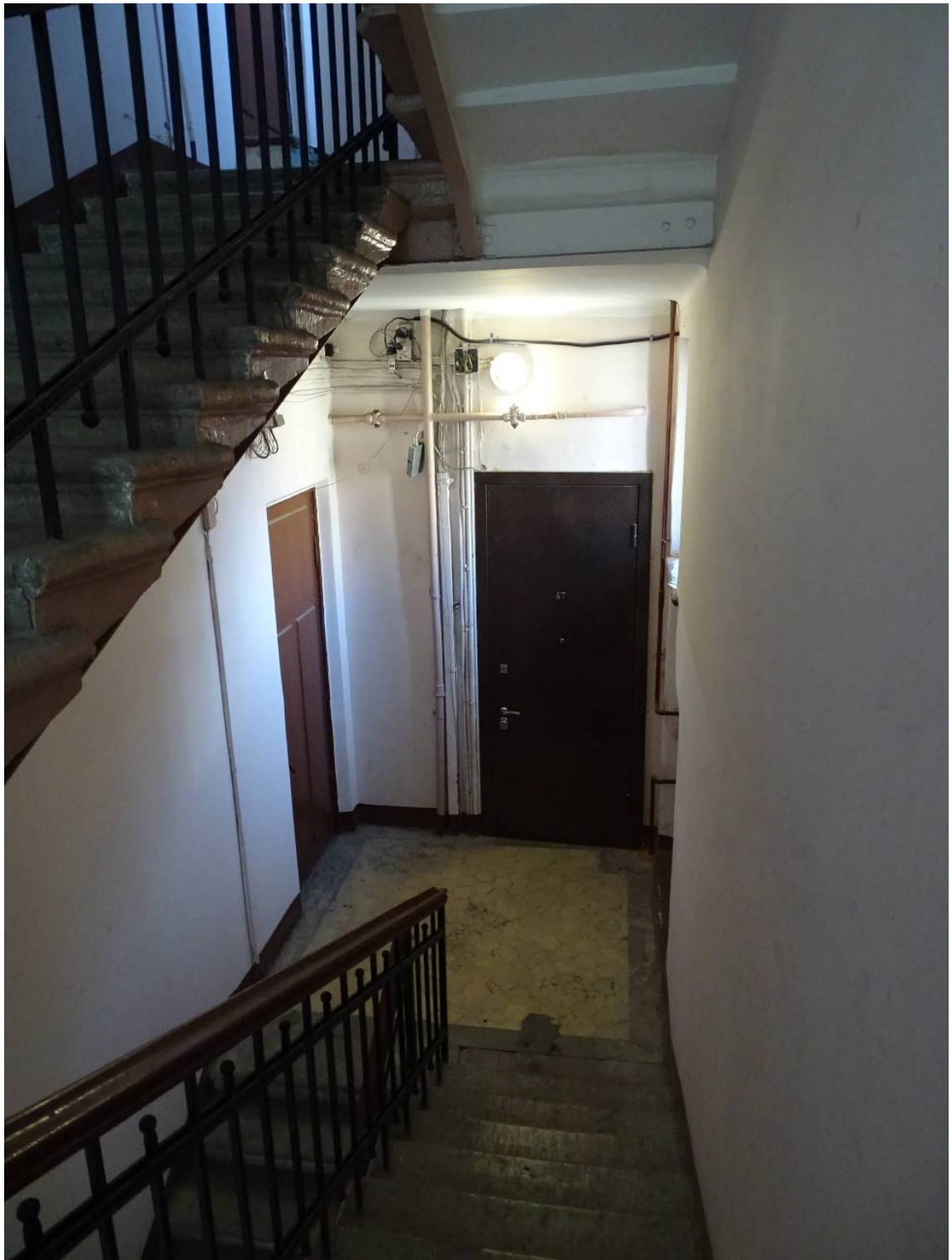
Фото 265. Лестница № 6: Площадка 4-го этажа. Съемка 26.04.2021 г. Трушковский В.Э.
