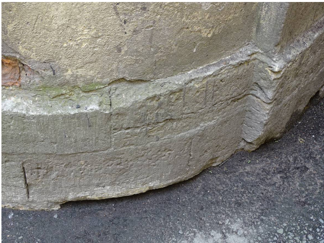
Фото 53. Здание по адресу: г. Санкт-Петербург, Кирочная ул., 22. Цоколь. Съемка 26.04.2021 г. Трушковский В.Э.
