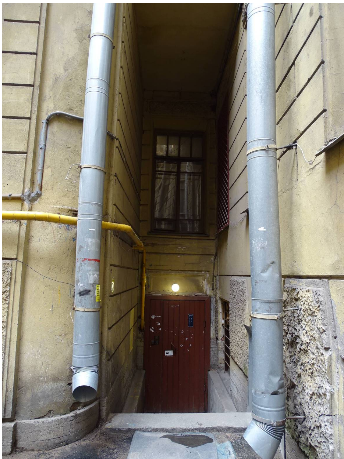
Фото 61. Здание по адресу: г. Санкт-Петербург, Кирочная ул., 22. Фрагмент западного фасада южного внутреннего двора. Вход на лестницу №6.
