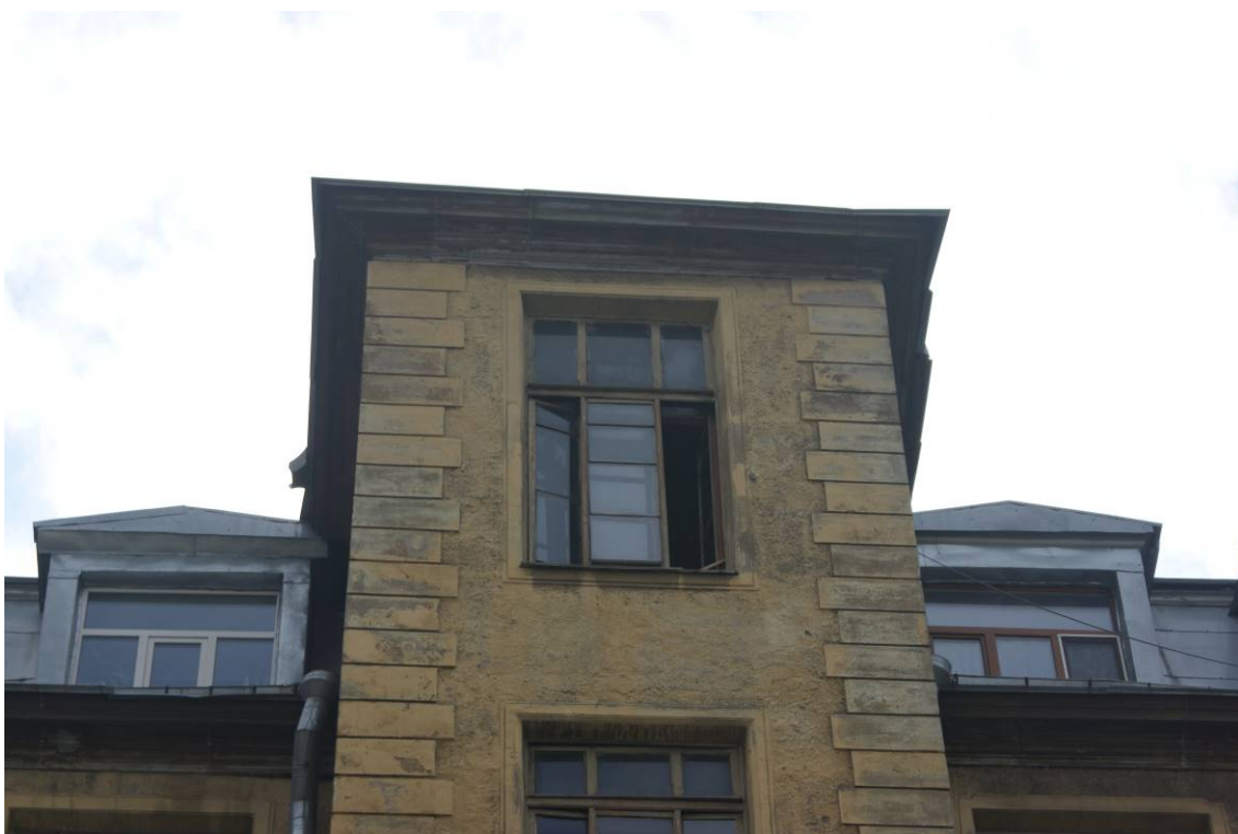
Фото 70. Здание по адресу: г. Санкт-Петербург, Кирочная ул., 22. Фрагмент южного фасада северного внутреннего двора. Ризалит. 6-й этаж. Съемка 26.04.2021 г. Трушковский В.Э.
