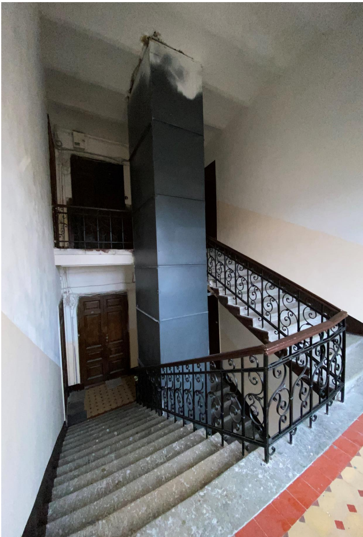
79. Лестница 2ЛК в уровне 5-6-го этажей
