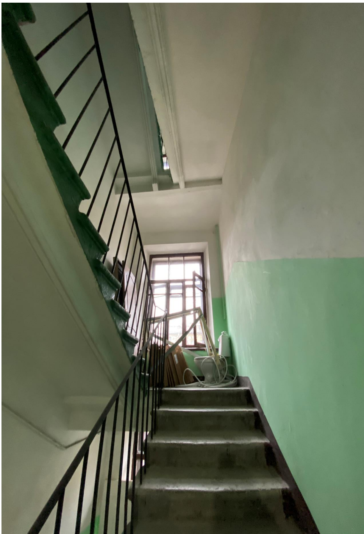
88. Лестница 4ЛК в уровне 2-3-го этажей.
