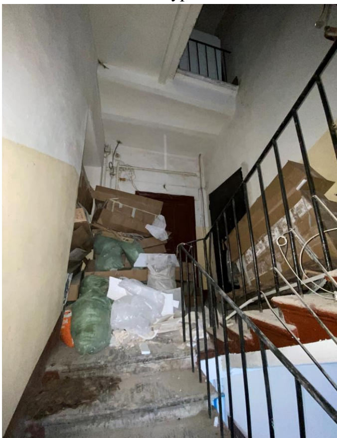
114. Лестница ЗЛК в уровне чердака
