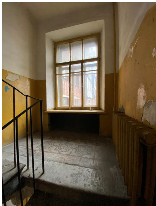
124. Лестница 1ЛК в уровне 2-3-го этажей
