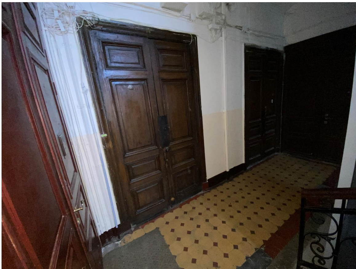
65. Лестница 2ЛК в уровне 2-го этажа
