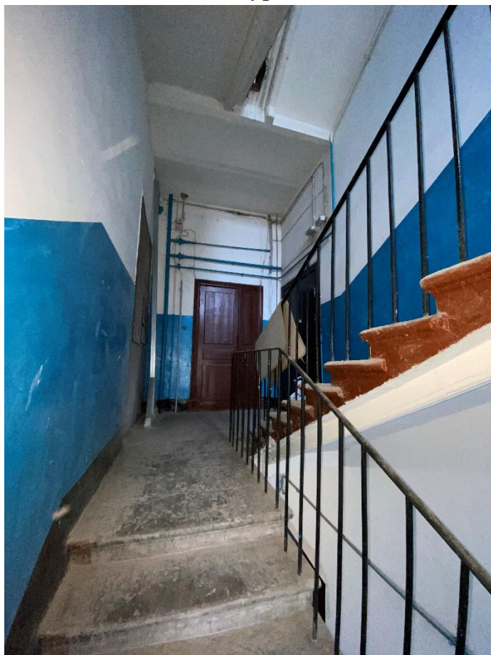
106. Лестница 3ЛК в уровне 3-го этажа
