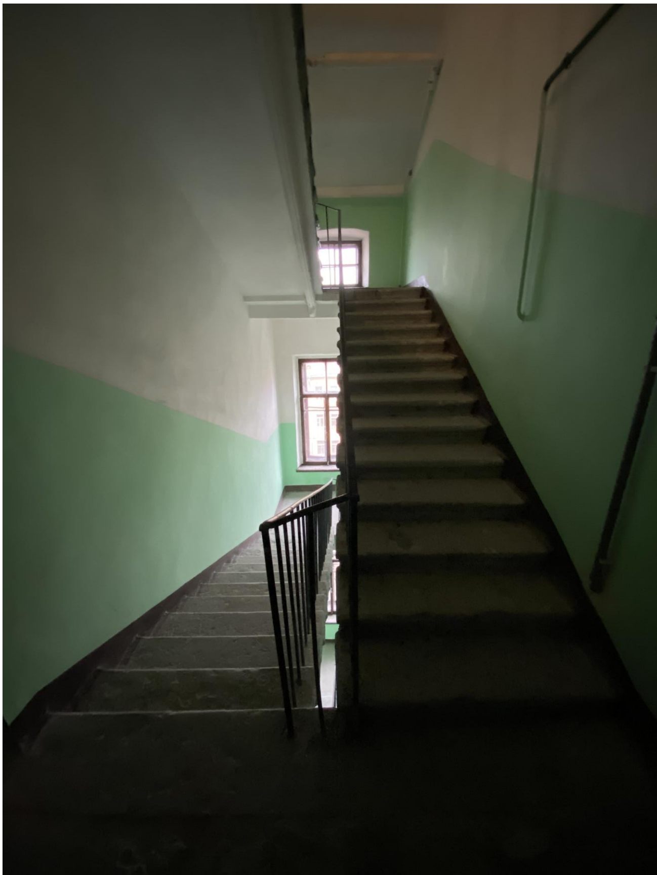
96. Лестница 4ЛК в уровне 6-го этажа и чердака
