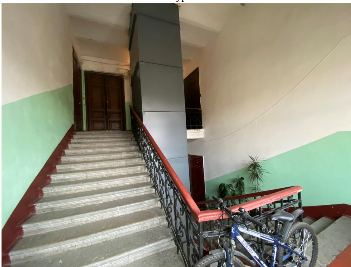
51. Лестница 5ЛК в уровне 5-6-го этажей
