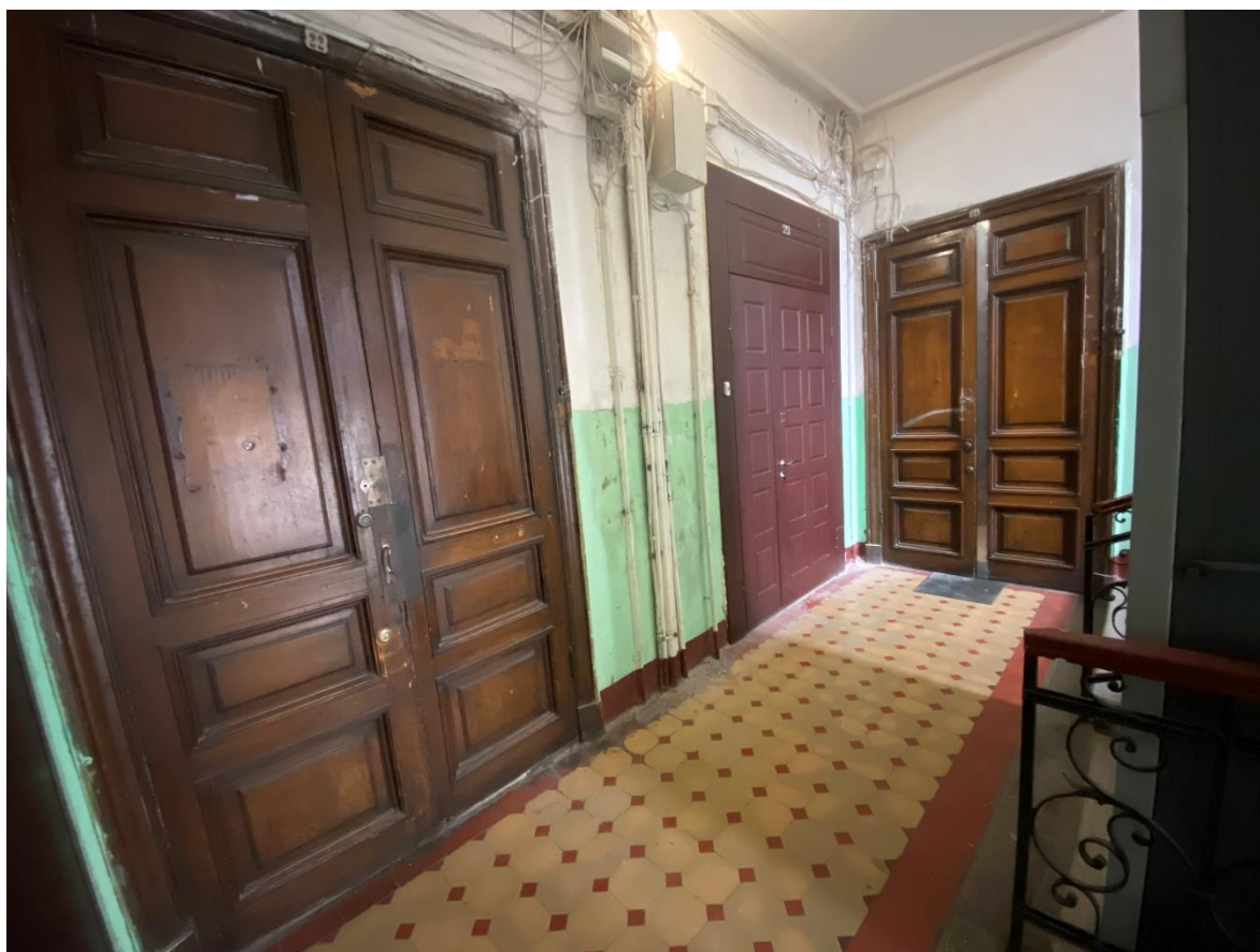
36. Лестница 5ЛК в уровне 2-го этажа
