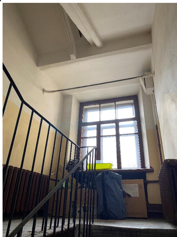
139. Лестница БЛК в уровне 1-2-го этажей
