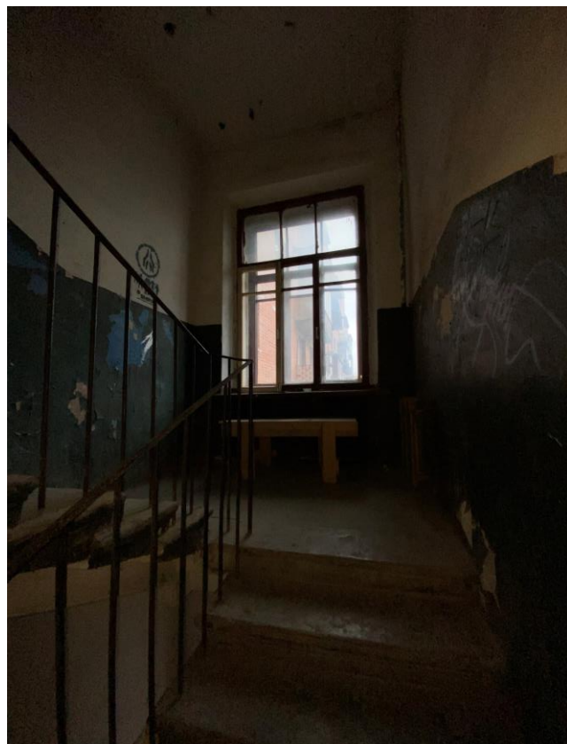
126. Лестница 1ЛК в уровне 3-4-го этажей
