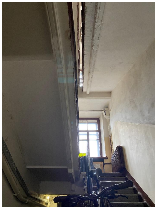
138. Лестница БЛК в уровне 1-го этажа
