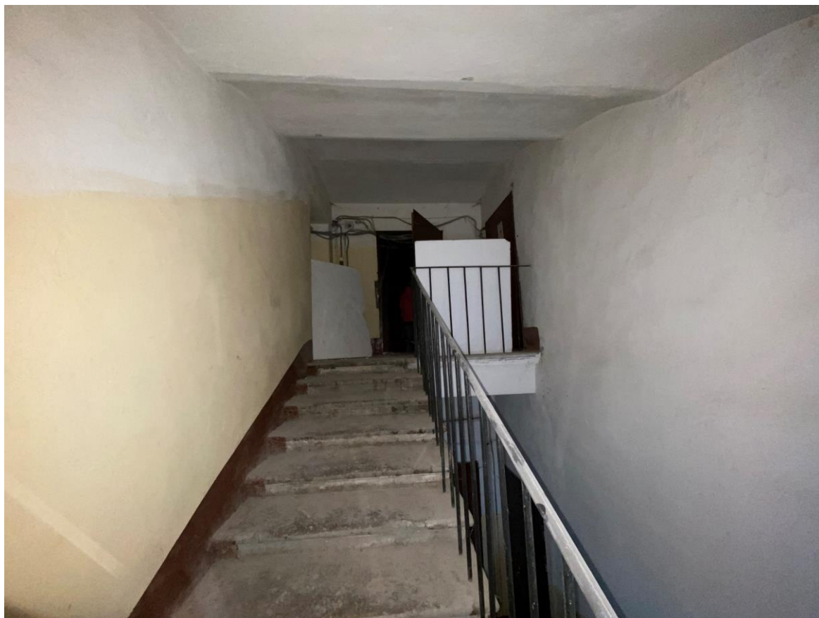
116. Лестница ЗЛК в уровне чердака
