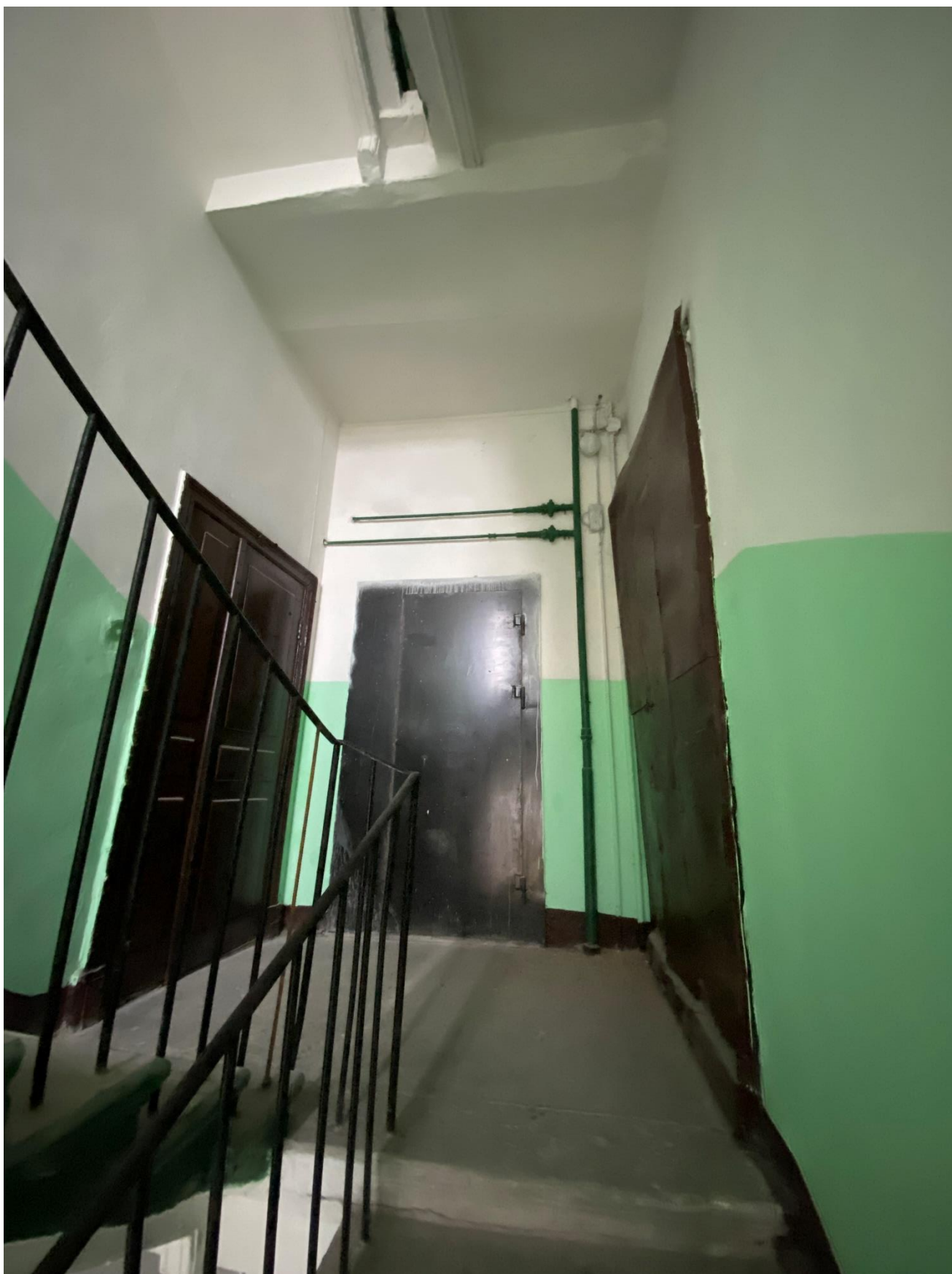
93. Лестница 4ЛК в уровне 5-го этажа
