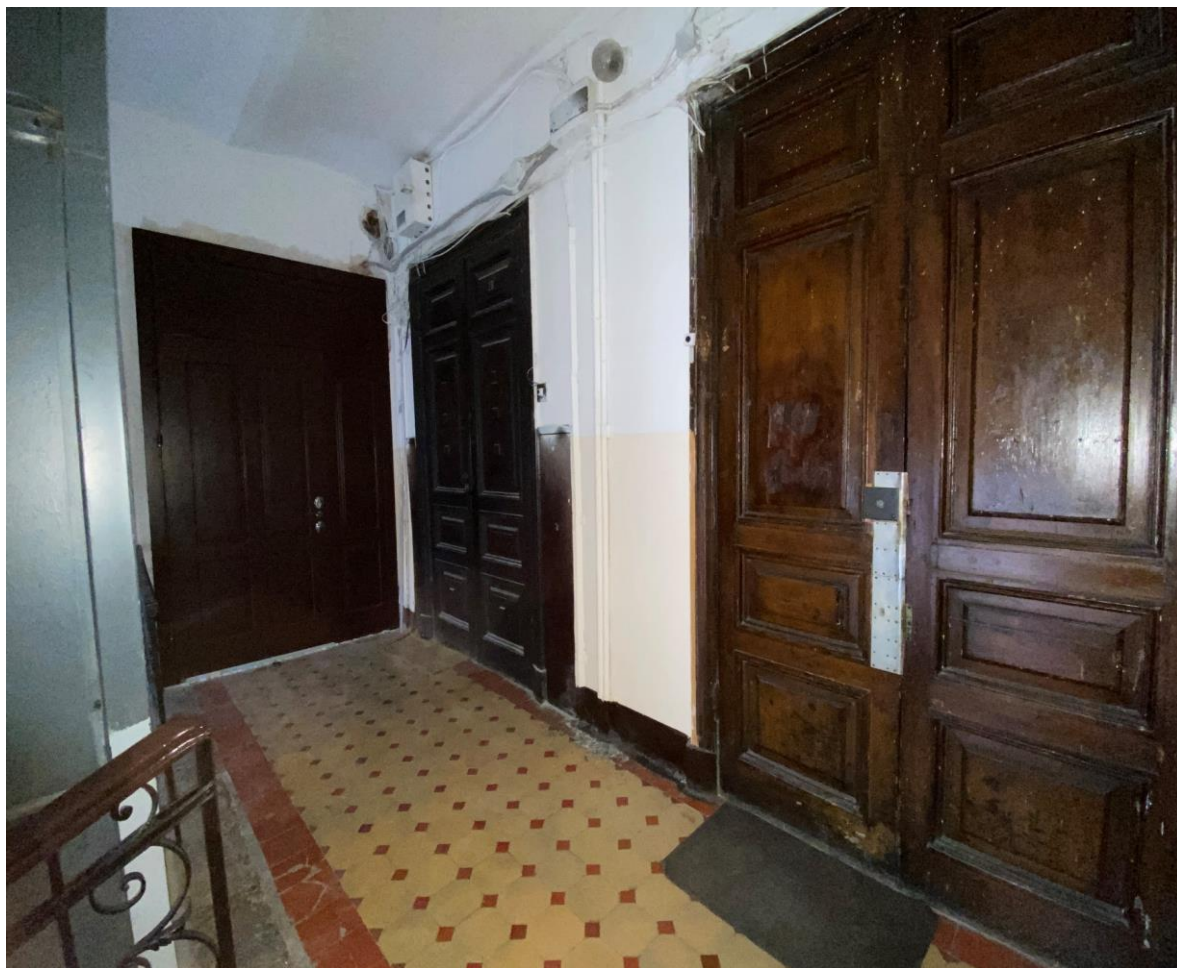
82. Лестница 2ЛК в уровне 6-го этажа
