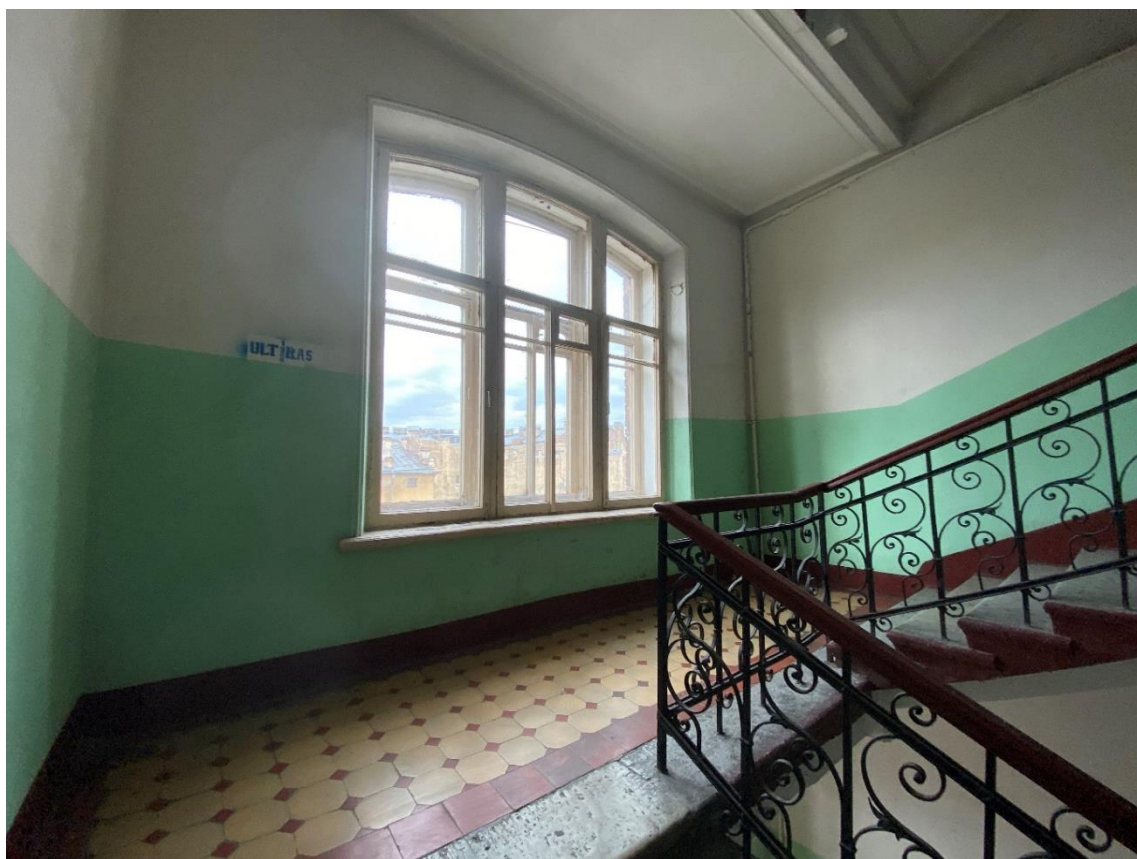
46. Лестница 5ЛК в уровне 4-5-го этажей
