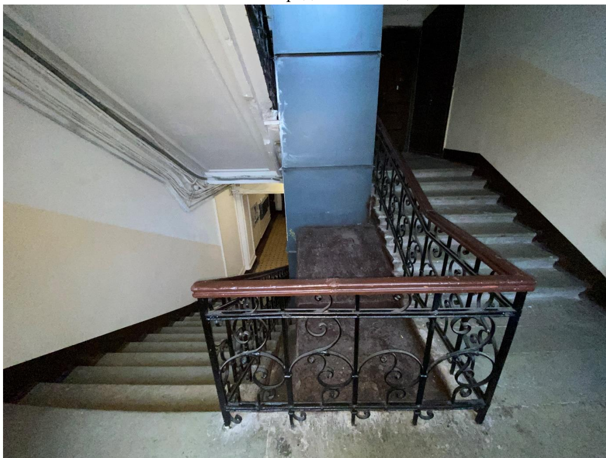
62. Лестница 2ЛК в уровне 1-2-го этажей
