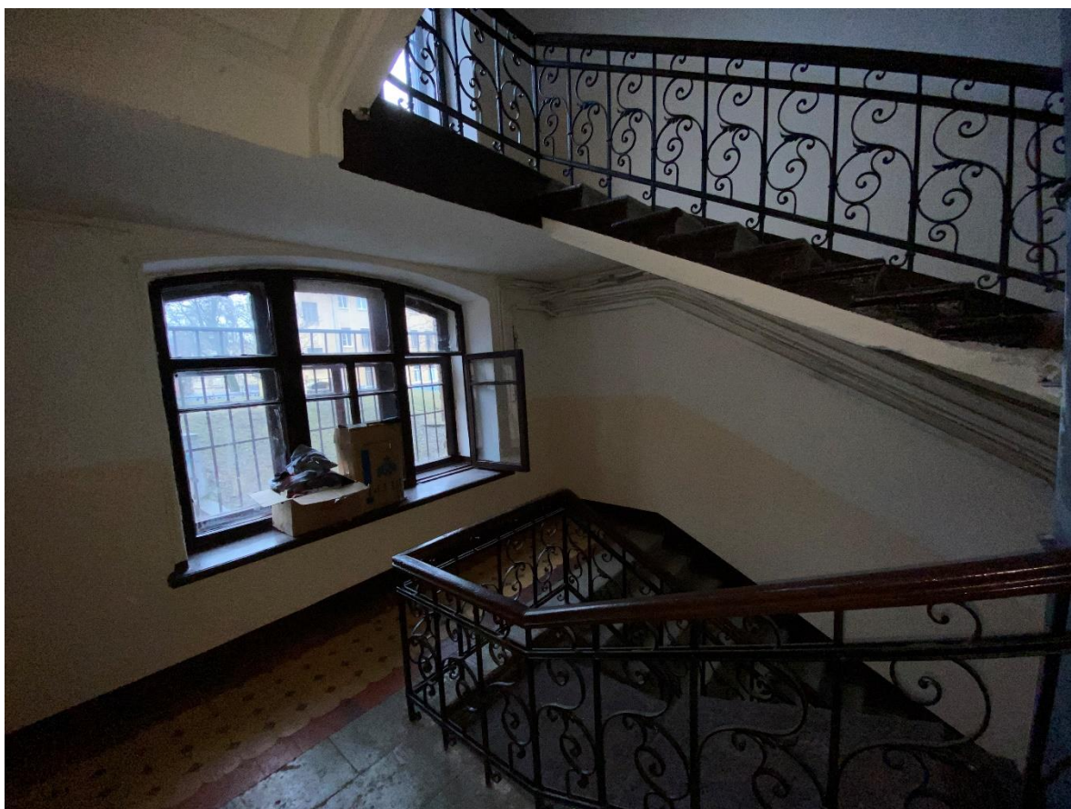
63. Лестница 2ЛК в уровне 1-2-го этажей
