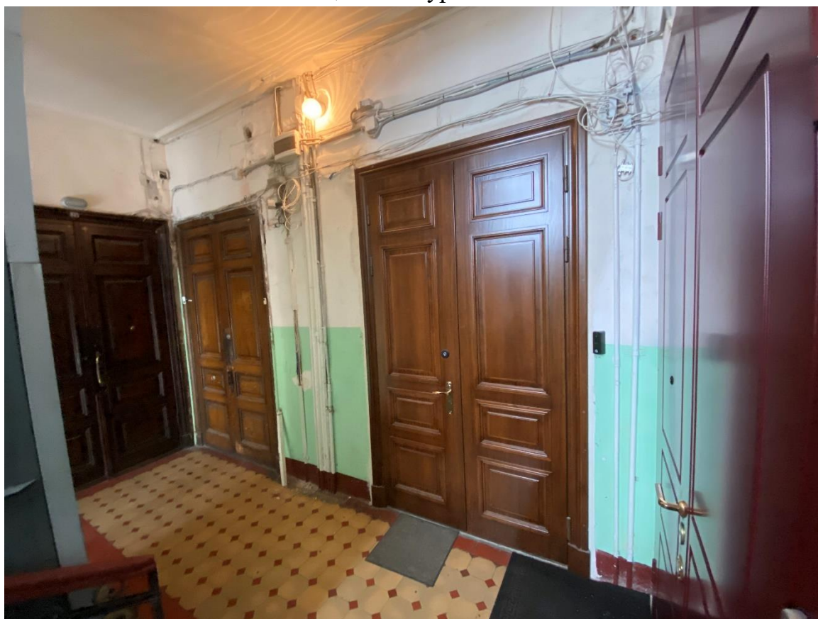
45. Лестница 5ЛК в уровне 4-го этажа
