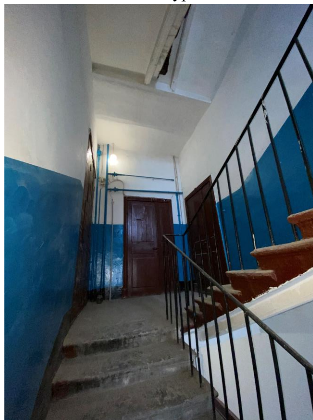
111. Лестница ЗЛК в уровне 5-го этажа
