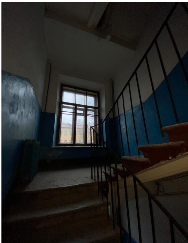
104. Лестница 3ЛК в уровне 2-3-го этажей
