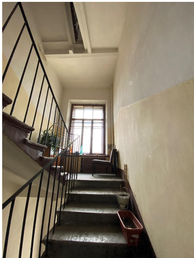
150. Лестница БЛК в уровне 5-6-го этажей
