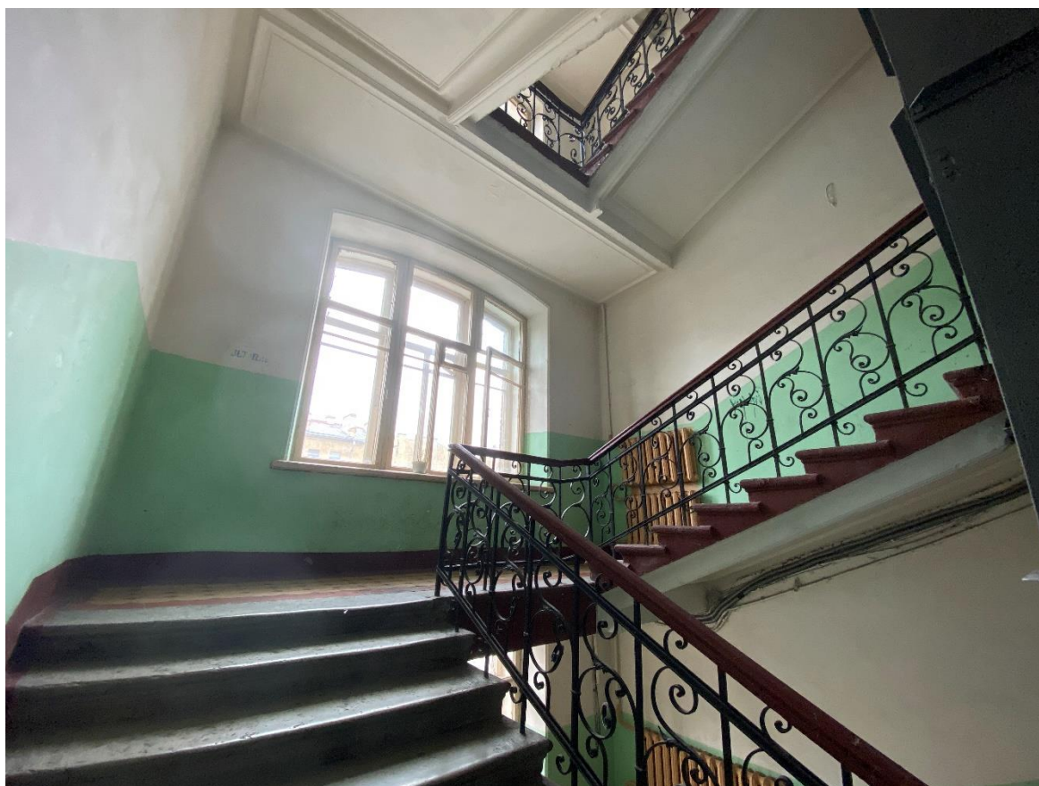
38. Лестница 5ЛК в уровне 2-3-го этажей
