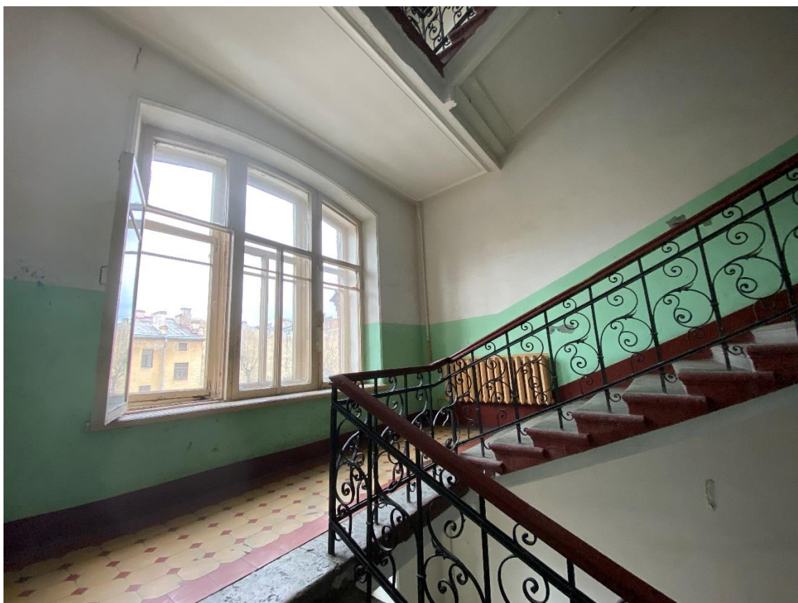
42. Лестница 5ЛК в уровне 3-4-го этажей
