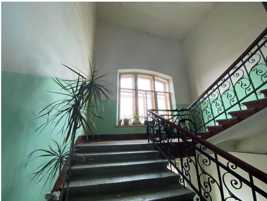
50. Лестница 5ЛК в уровне 5-6-го этажей
