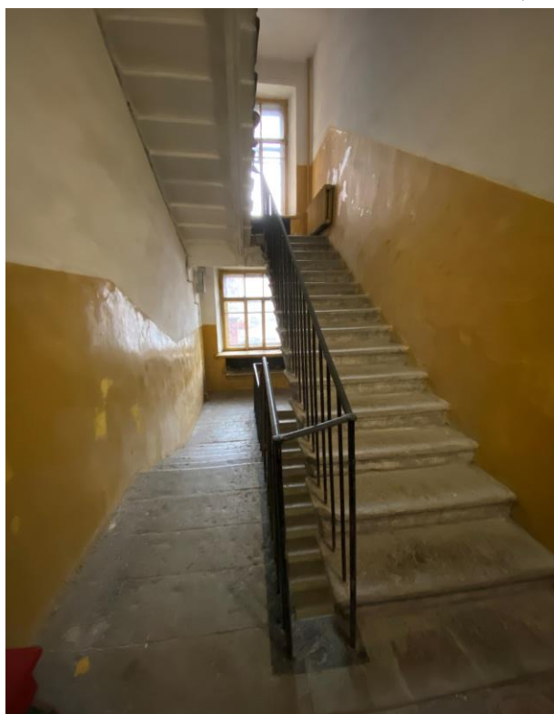
123. Лестница 1ЛК в уровне 2-го этажа
