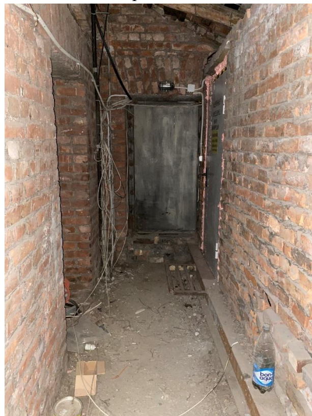
155. Помещение чердака над лестницей 6 ЛК.
