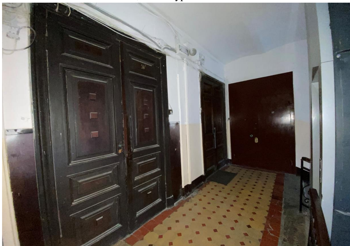
81. Лестница 2ЛК в уровне 6-го этажа
