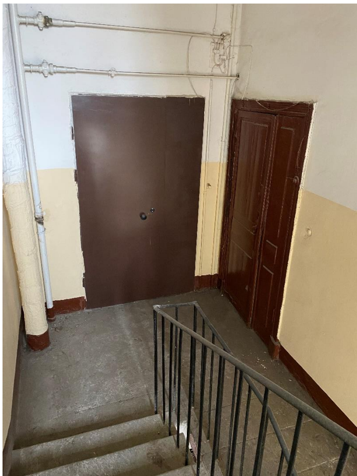
144. Лестница БЛК в уровне 3-го этажа
