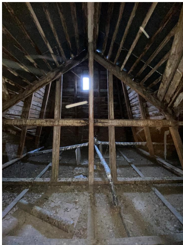
153. Помещение чердака над лестницей 6 ЛК
