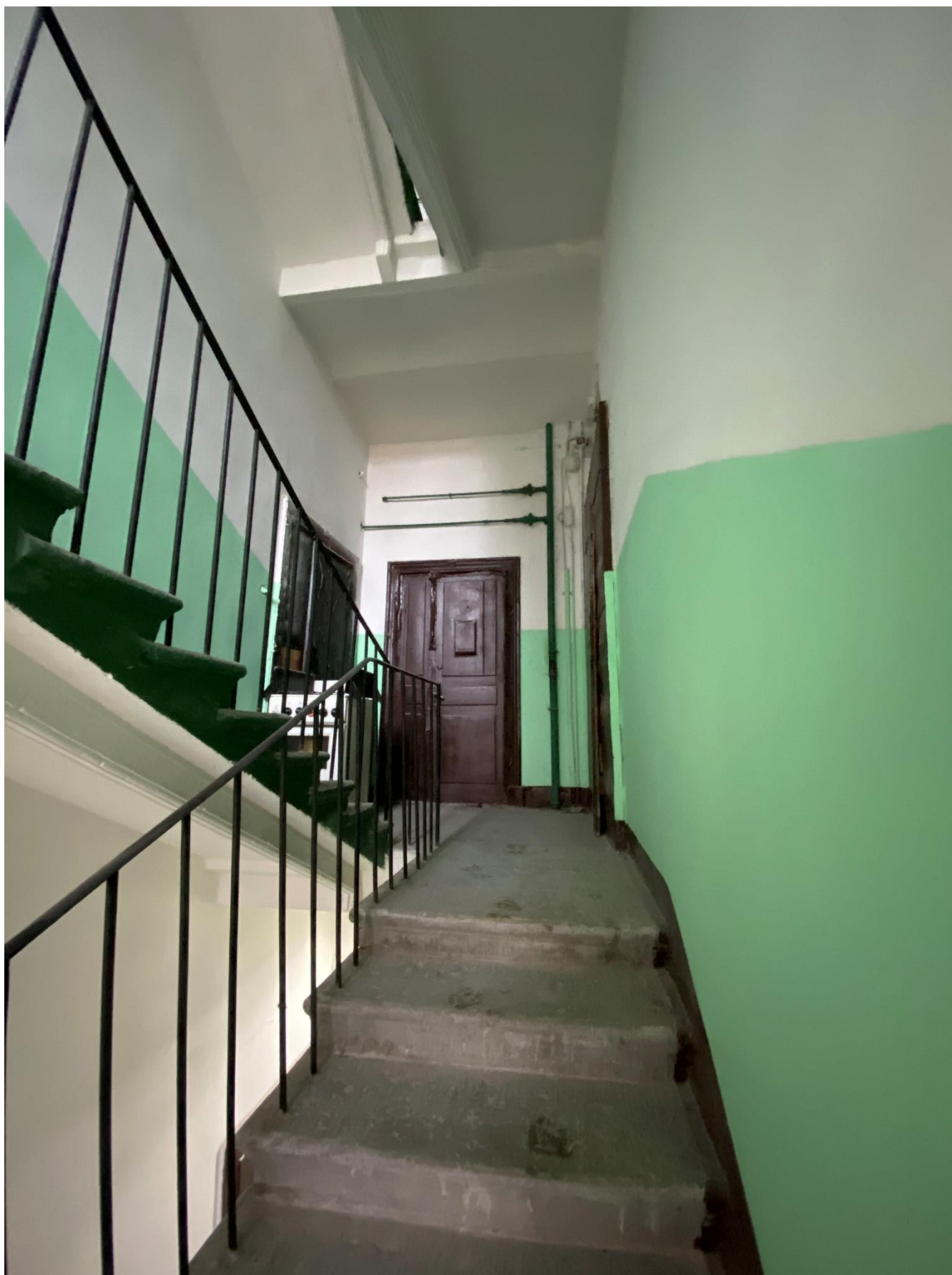
89. Лестница 4ЛК в уровне 3-го этажа.
