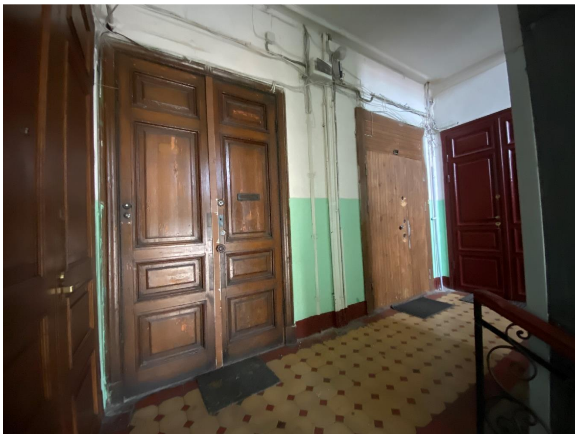
48. Лестница 5ЛК в уровне 5-го этажа
