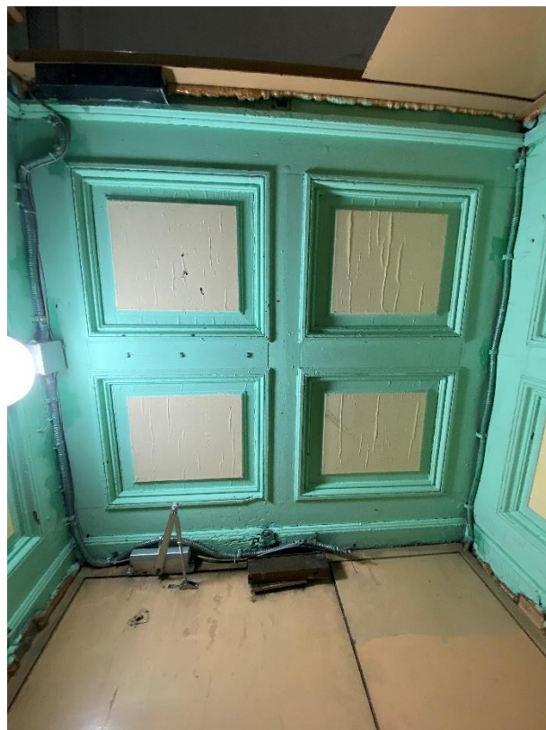
27. Потолок тамбура лестницы 5ЛК
