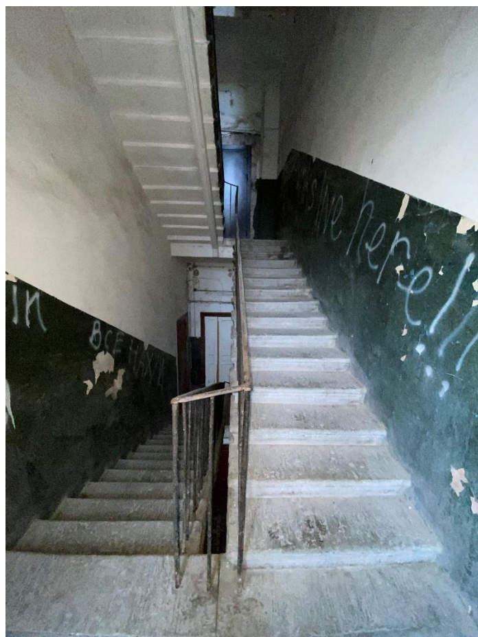
130. Лестница 1ЛК в уровне 4-5-го этажей
