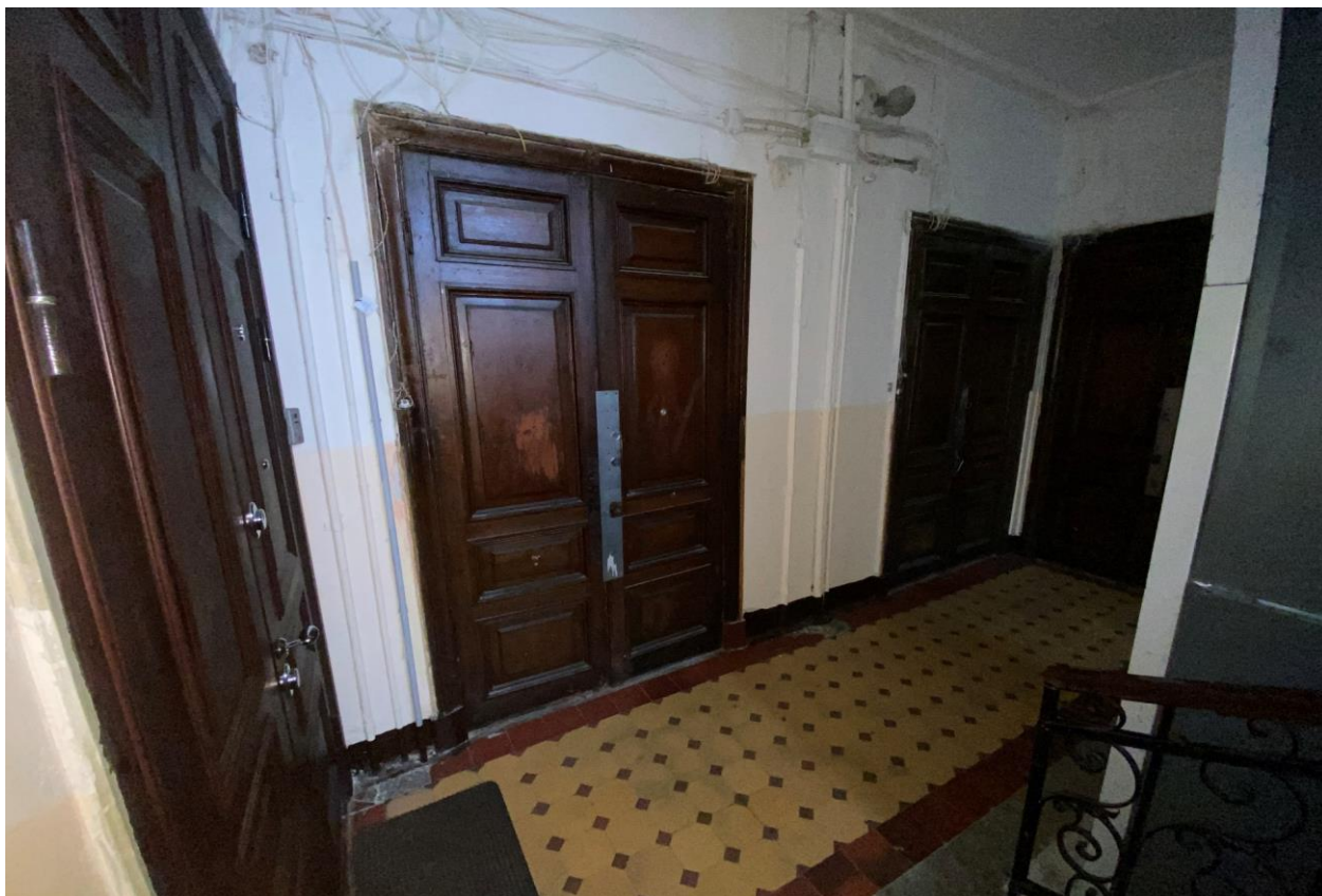
69. Лестница 2ЛК в уровне 3-го этажа
