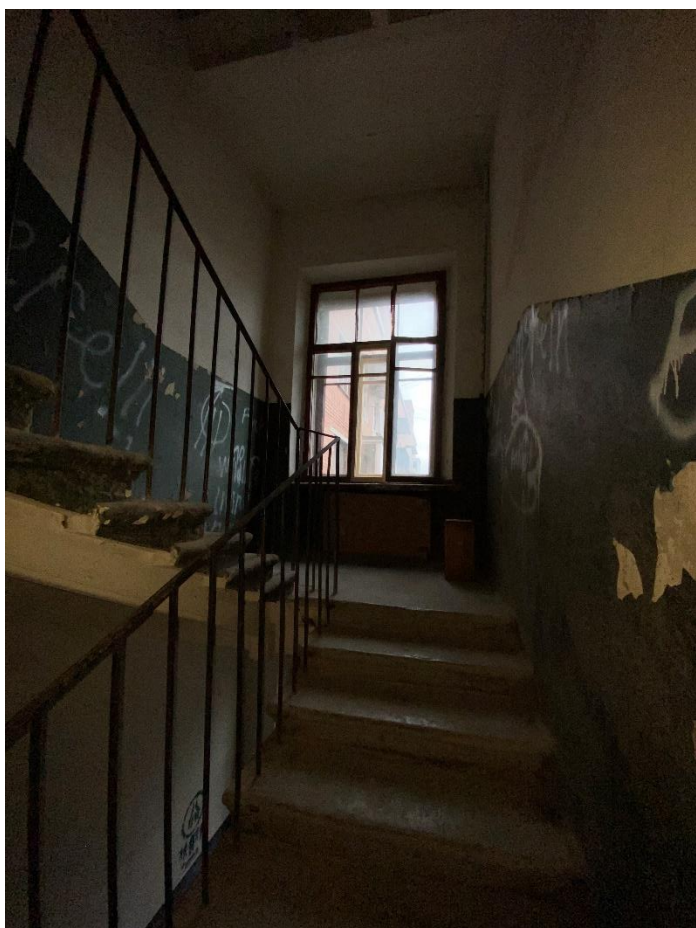
129. Лестница 1ЛК в уровне 4-5-го этажей
