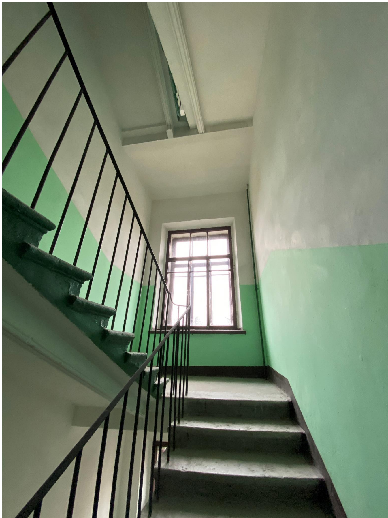
92. Лестница 4ЛК в уровне 4-5-го этажей.
