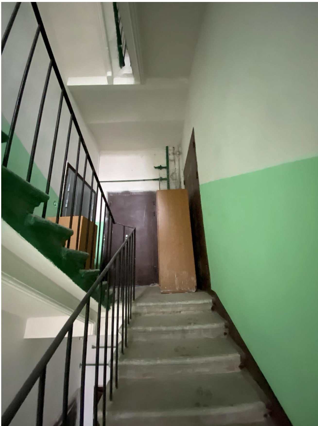
91. Лестница 4ЛК в уровне 4-го этажа.
