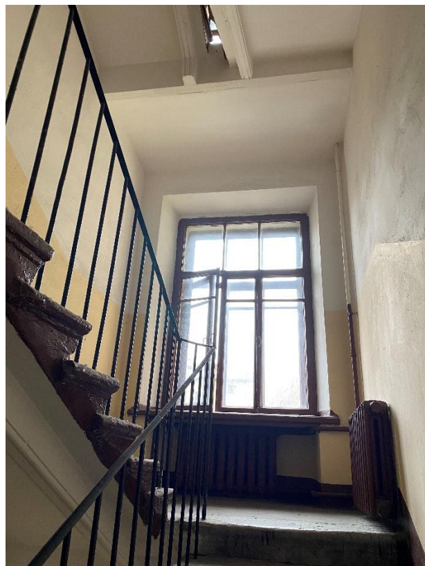
141. Лестница БЛК в уровне 2-3-го этажей
