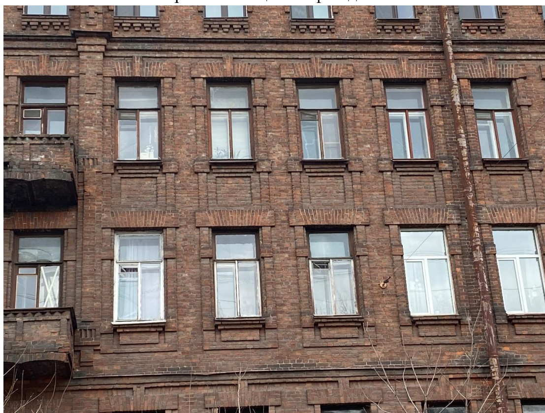
12. Фрагмент лицевого фасада. Оформление оконных проемов 3-4-го этажей
