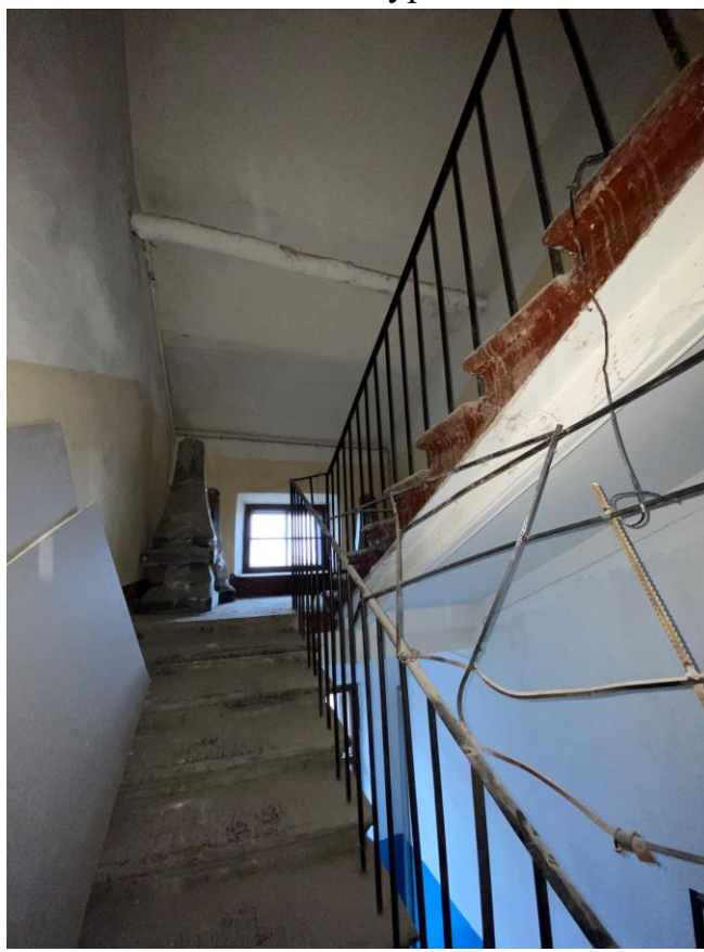
115. Лестница ЗЛК в уровне чердака
