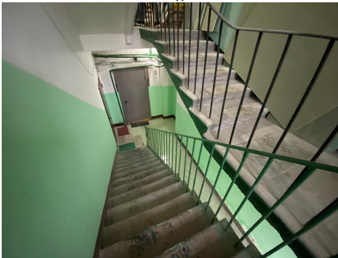
85. Лестница 4ЛК в уровне 1-2-го этажей
