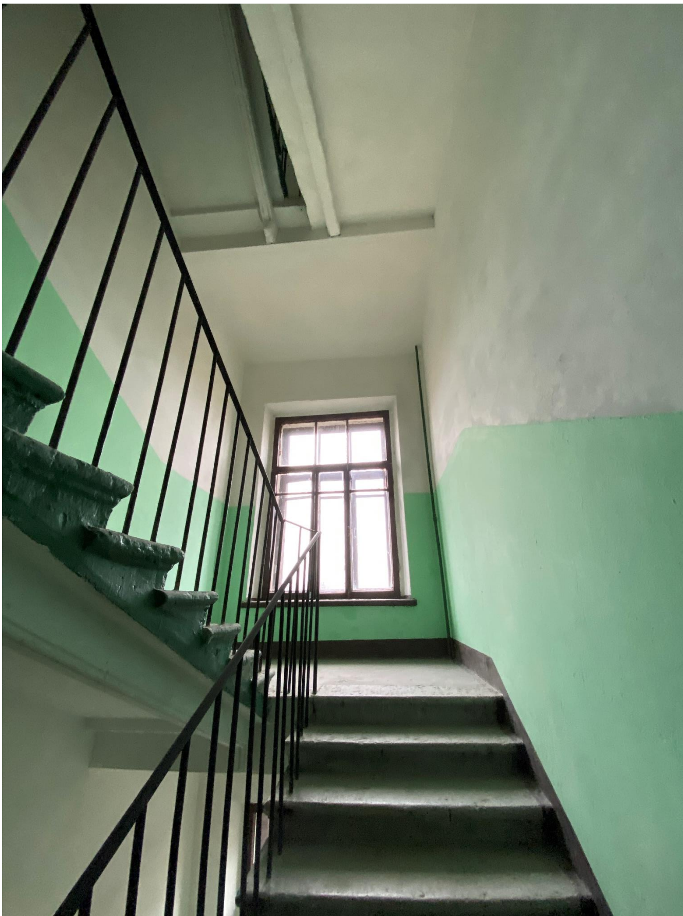
94. Лестница 4ЛК в уровне 5-6-го этажей.
