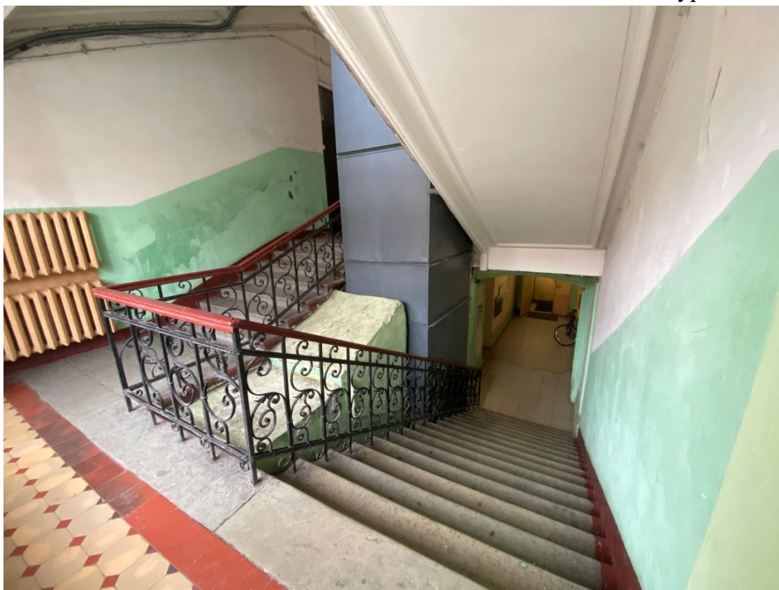
32. Лестница 5ЛК в уровне 1-го этажа
