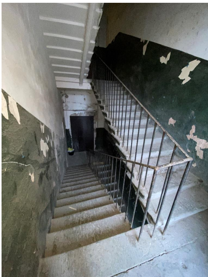
133. Лестница 1ЛК в уровне 5-6-го этажей
