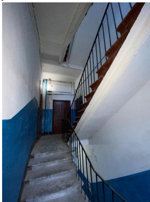
103. Лестница ЗЛК в уровне 2-го этажа
