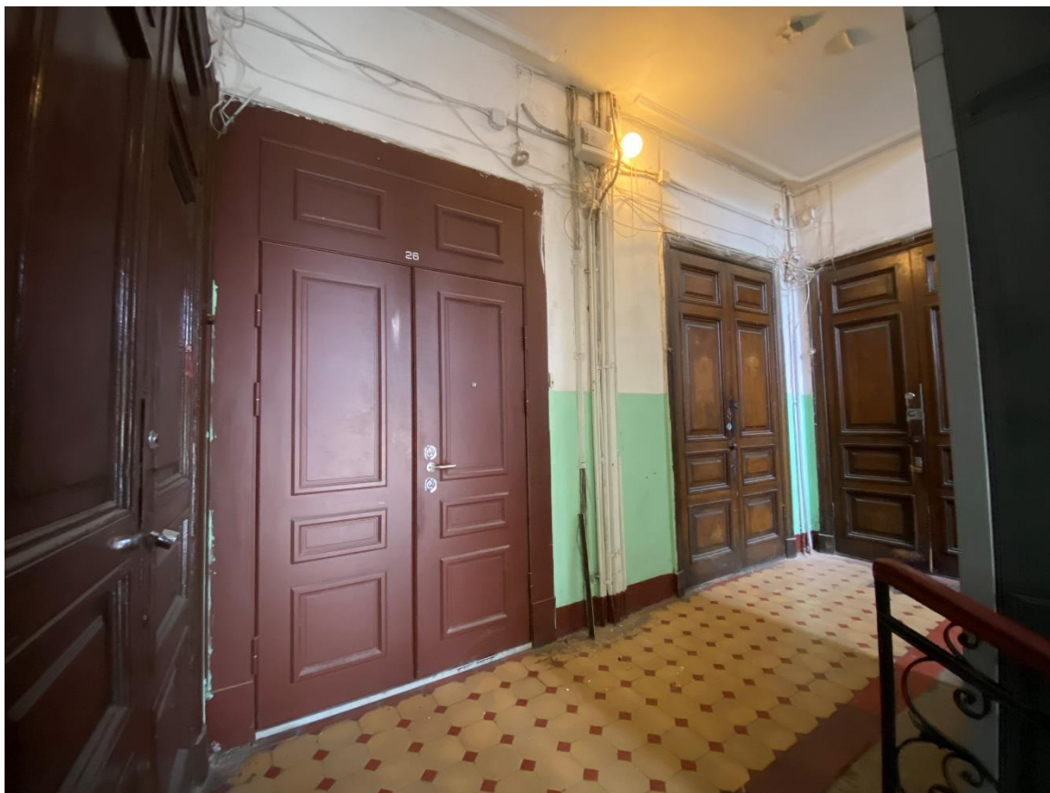
40. Лестница 5ЛК в уровне 3-го этажа
