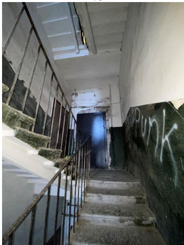
131. Лестница 1ЛК в уровне 5-го этажа
