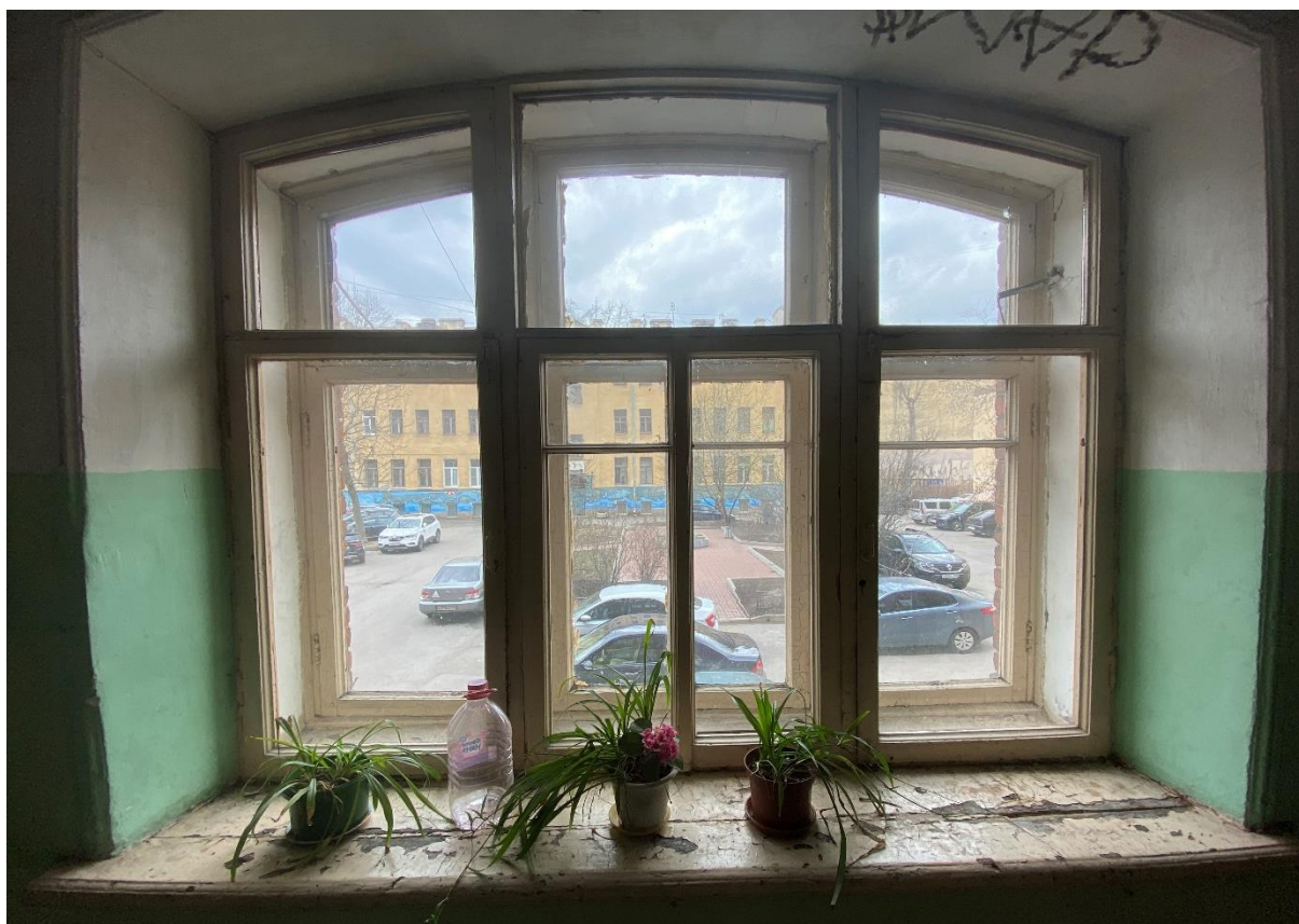
33. Оконный проем на лестнице 5ЛК в уровне 1-2-го этажей
