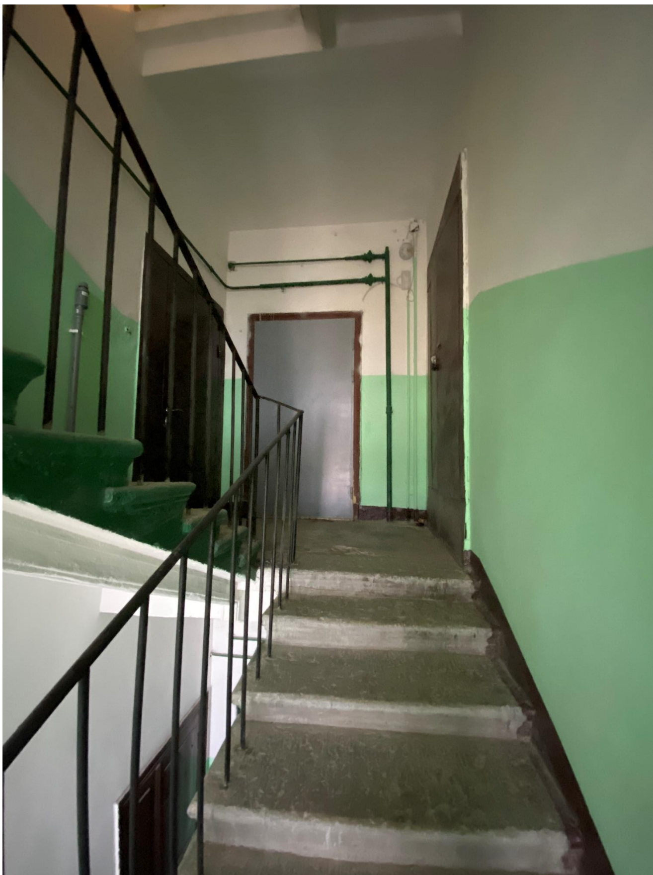
95. Лестница 4ЛК в уровне 6-го этажа
