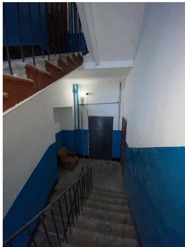
109. Лестница ЗЛК в уровне 4-го этажа
