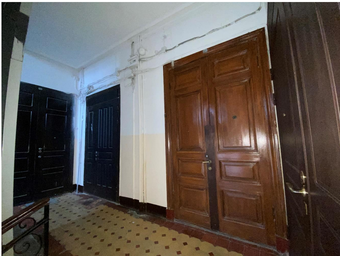
73. Лестница 2ЛК в уровне 4-го этажа
