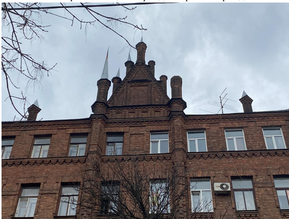
8. Завершение центральной части лицевого фасада
