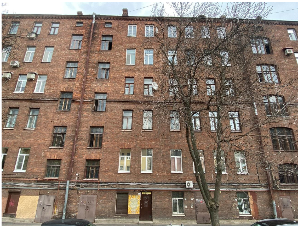
24. Фрагмент дворового фасада
