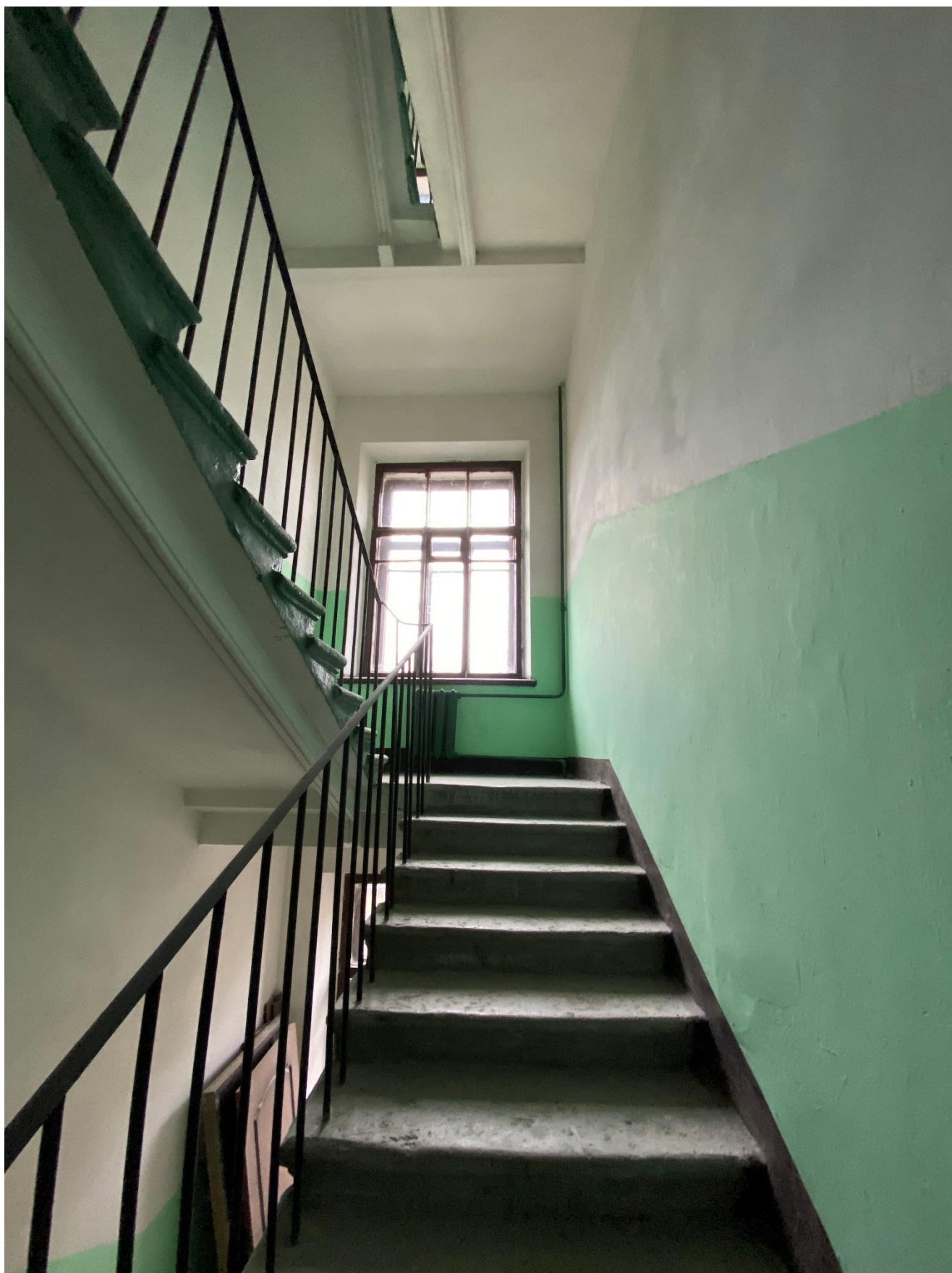
90. Лестница 4ЛК в уровне 3-4-го этажей.
