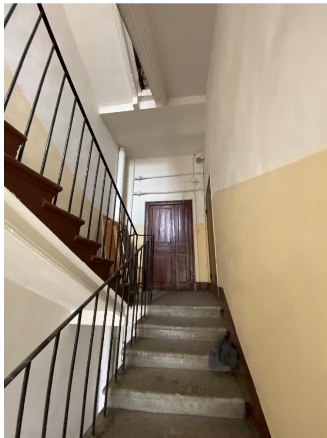
149. Лестница БЛК в уровне 5-го этажа
