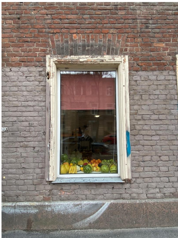
18. Фрагмент лицевого фасада. Оконный проем первого этажа
