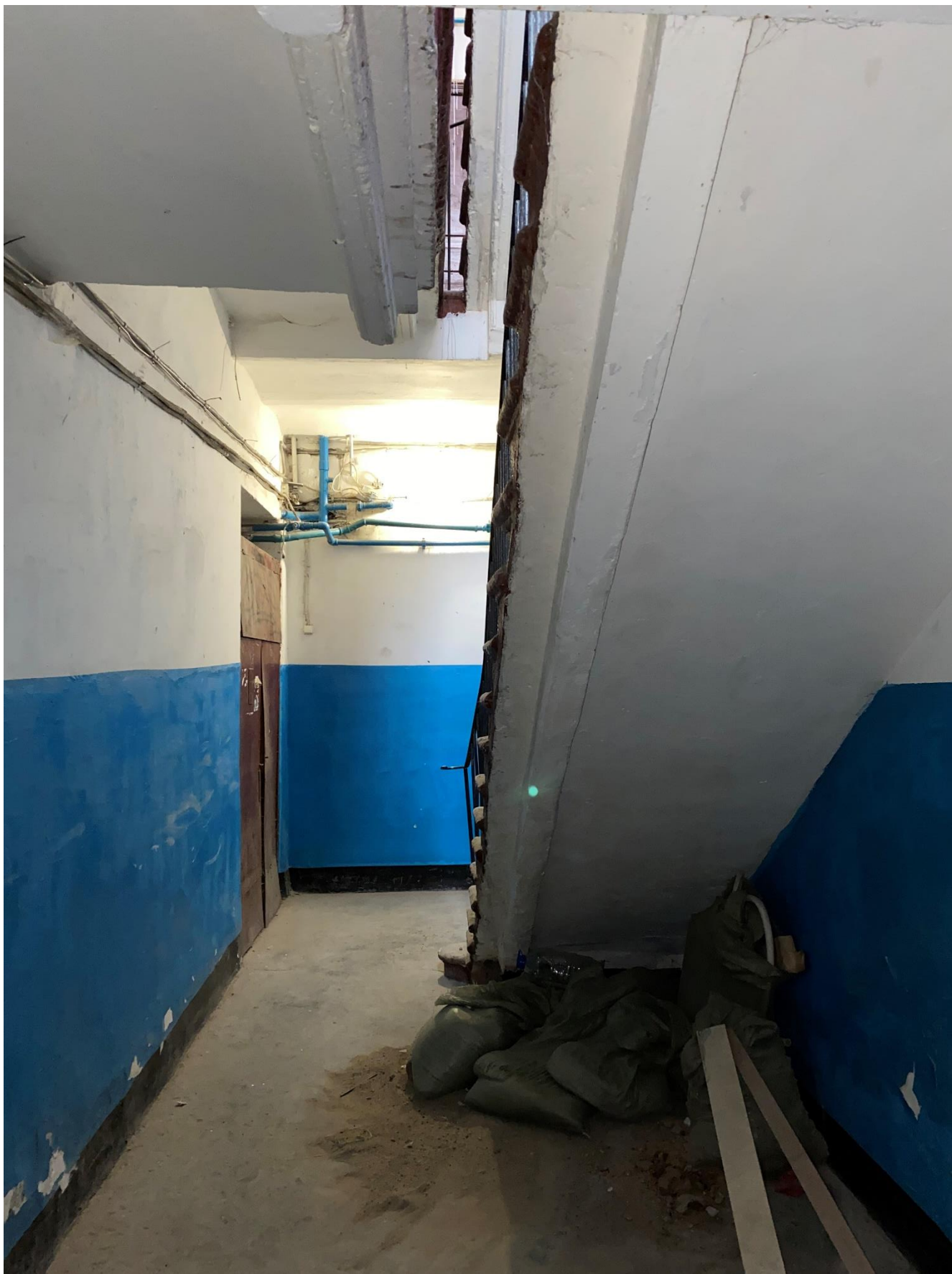
100. Лестница ЗЛК в уровне 1-го этажа
