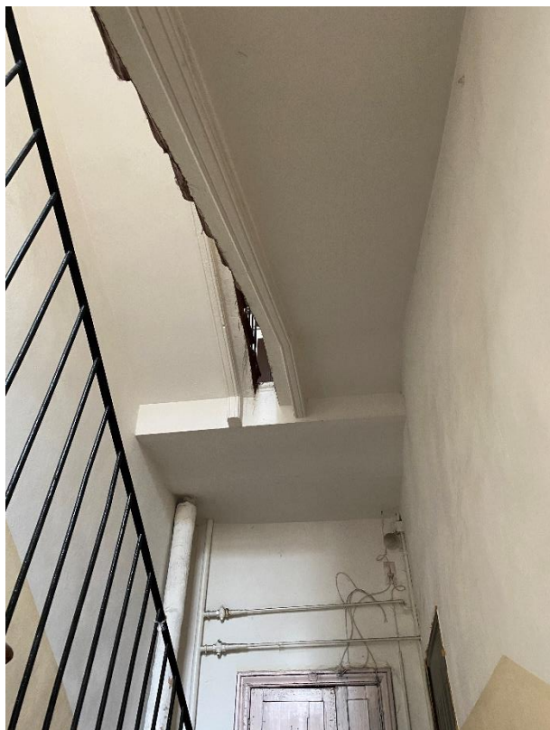
140. Лестница БЛК в уровне 2-го этажа
