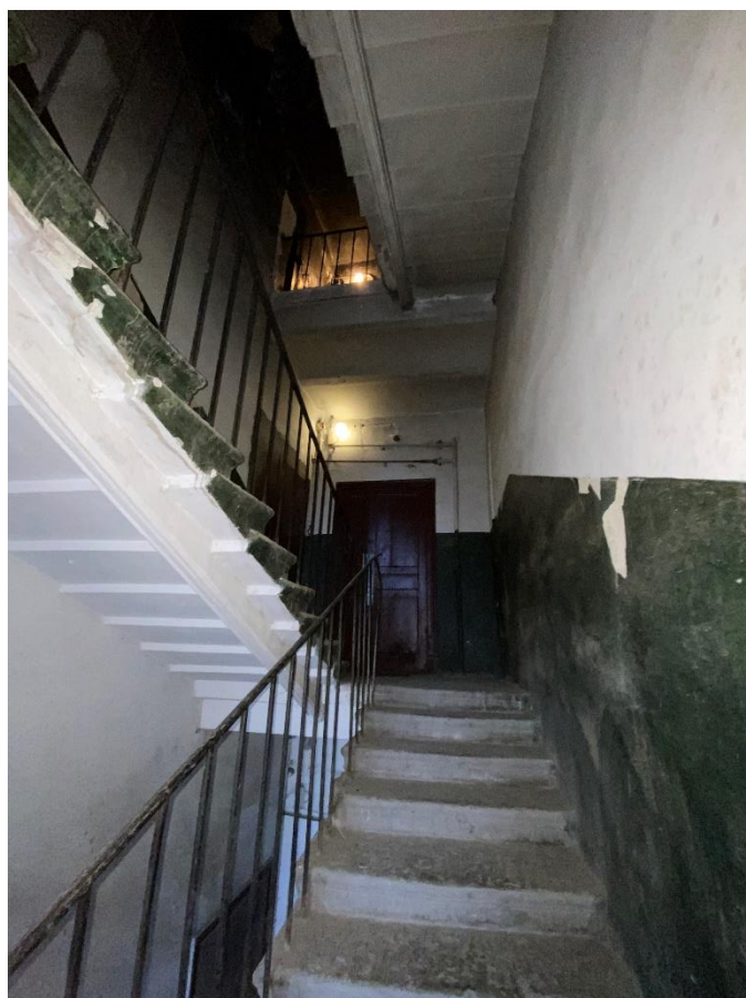
134. Лестница 1ЛК в уровне 6-го этажа
