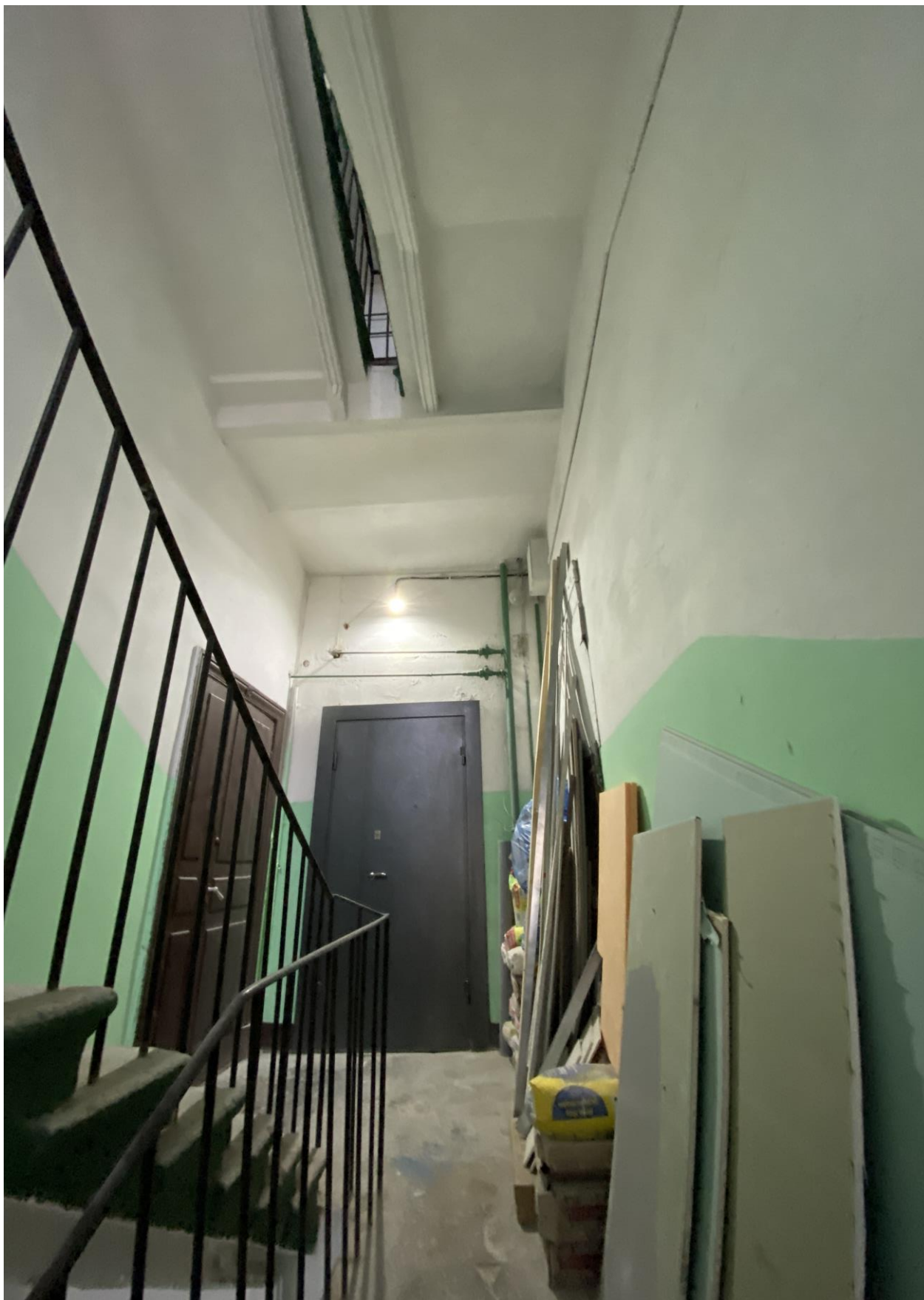
87. Лестница 4ЛК в уровне 2-го этажа.
