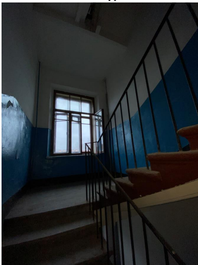
110. Лестница ЗЛК в уровне 4-5-го этажей
