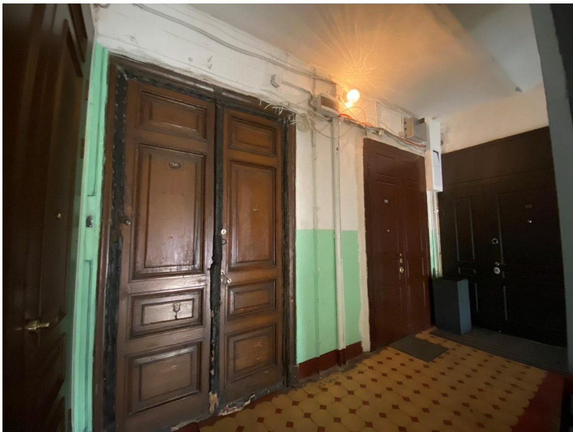
52. Лестница 5ЛК в уровне 6-го этажа
