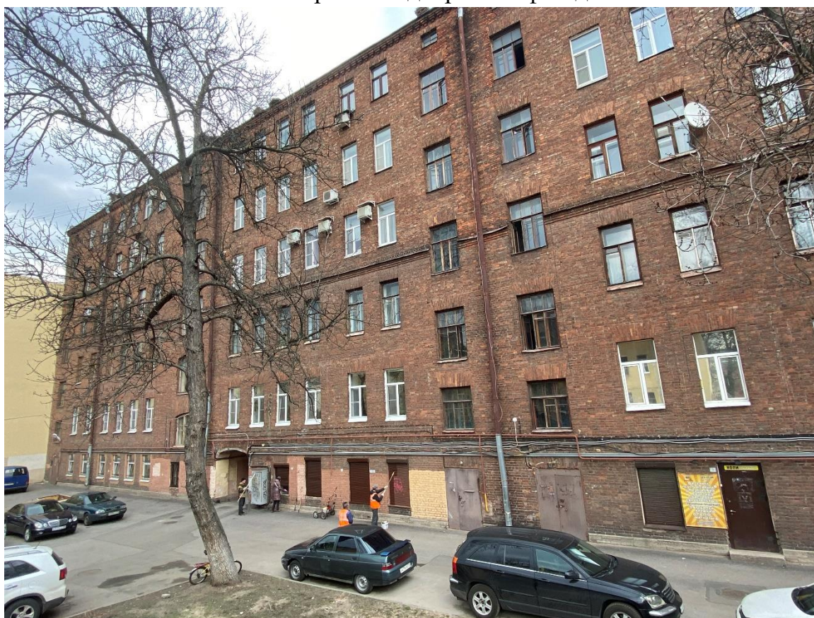
25. Фрагмент дворового фасада
