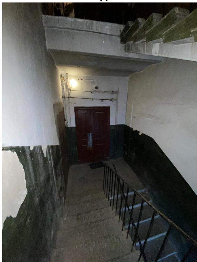
135. Лестница 1ЛК в уровне 6-го этажа
