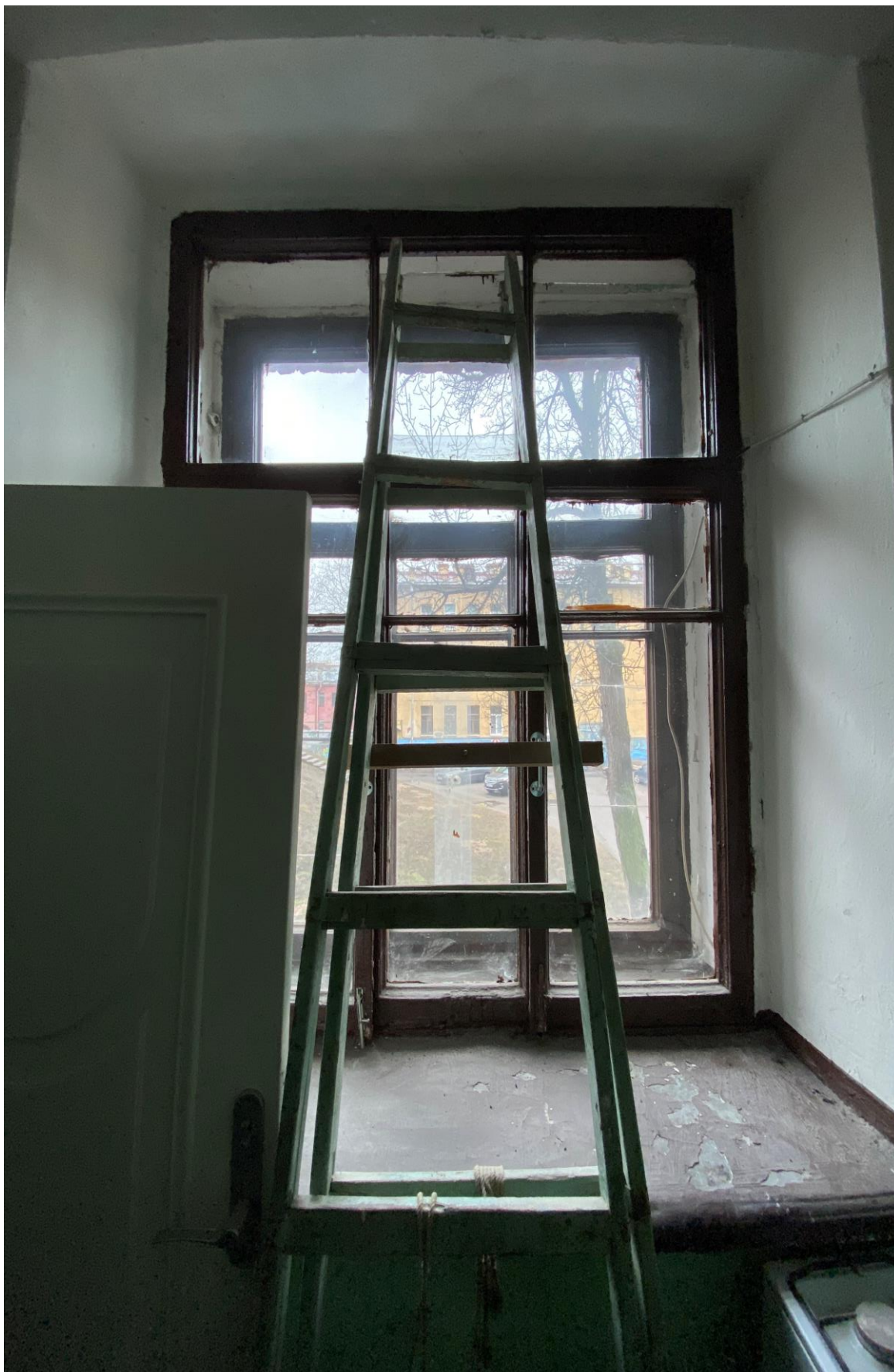
86. Лестница 4ЛК в уровне 1-2-го этажей. Оконный проем
