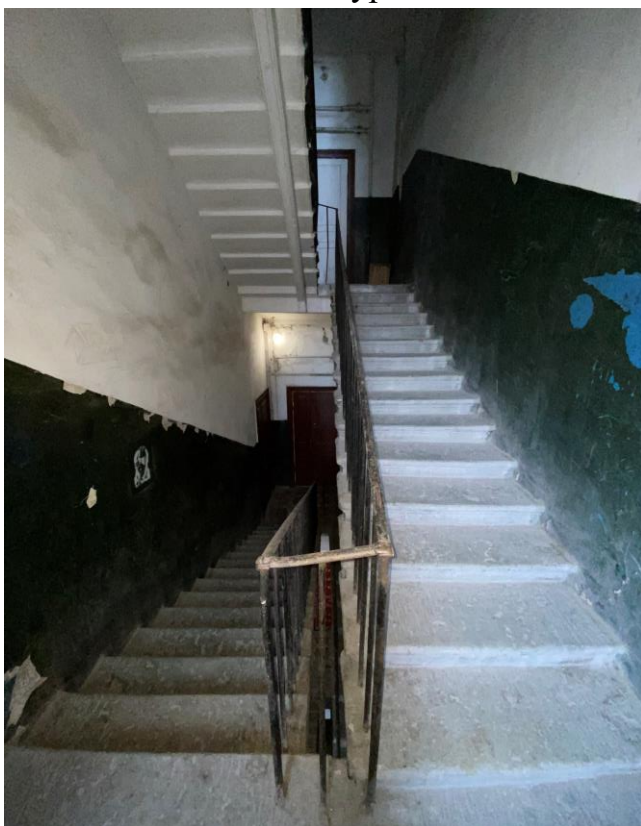
127. Лестница 1ЛК в уровне 3-4-го этажей
