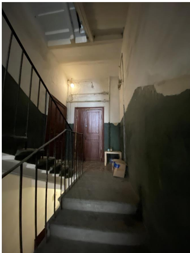
125. Лестница 1ЛК в уровне 3-го этажа
