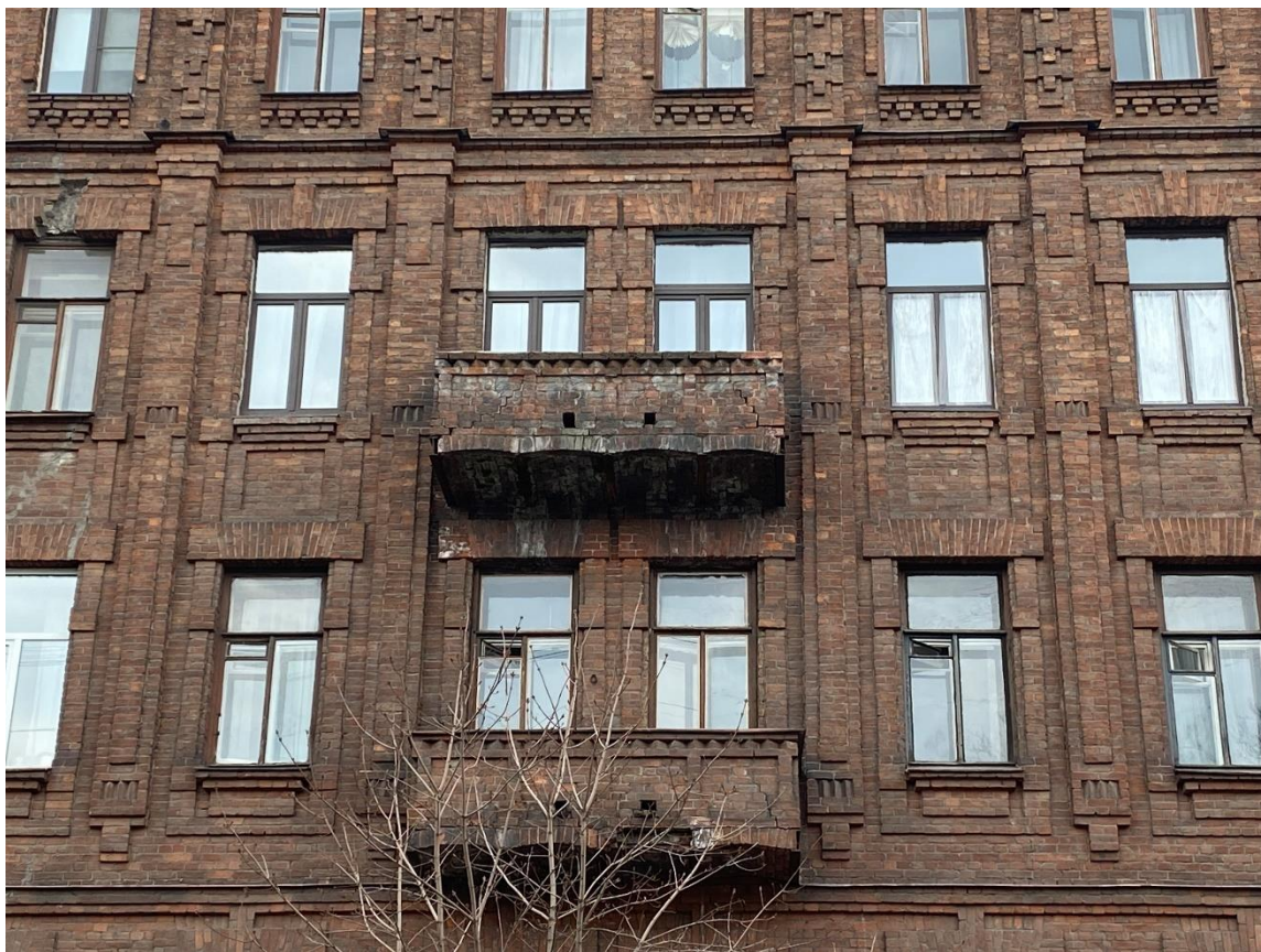
11. Фрагмент лицевого фасада. Балконы
