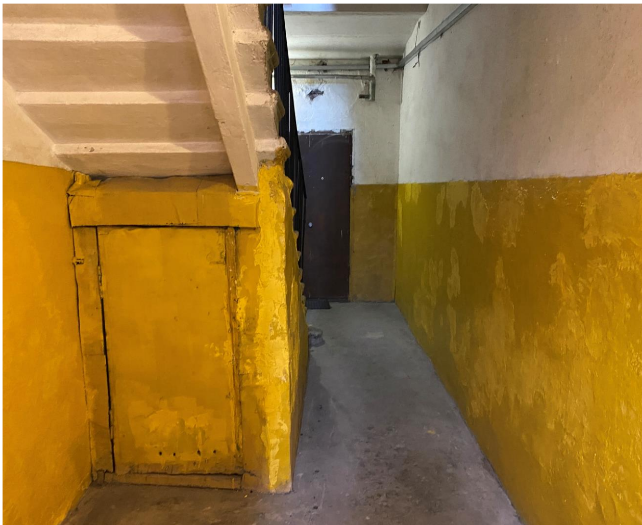
119. Лестница 1ЛК в уровне 1-го этажа
