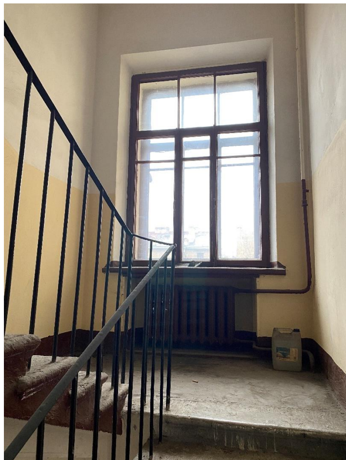
145. Лестница БЛК в уровне 3-4-го этажей
