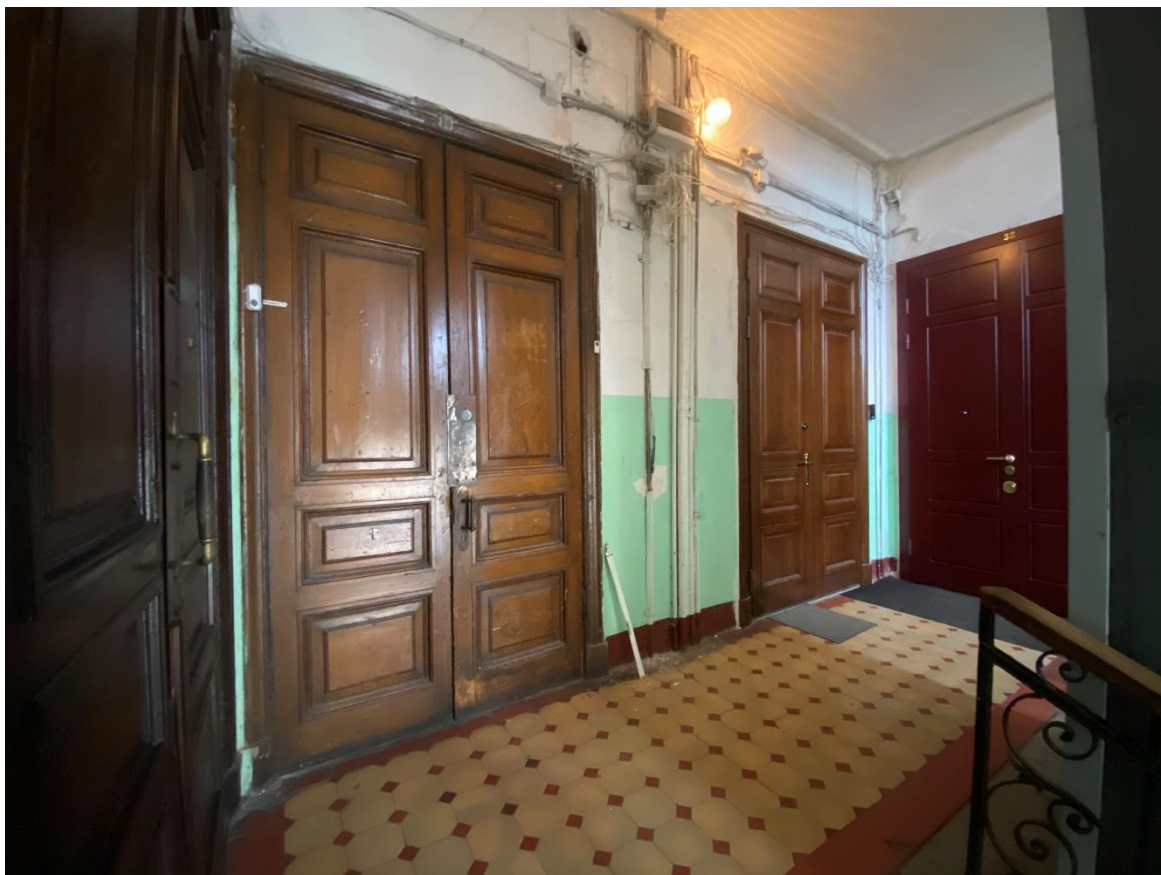
44. Лестница 5ЛК в уровне 4-го этажа
