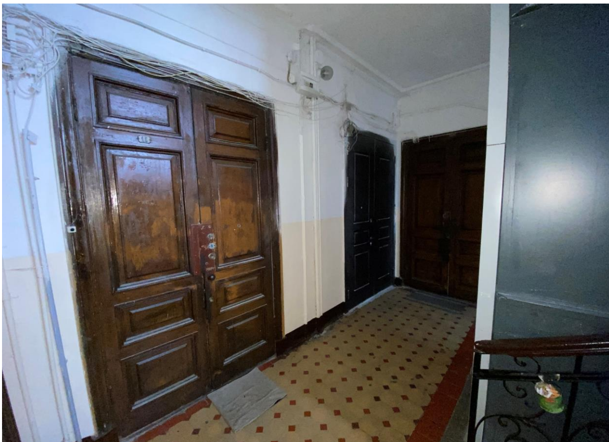
77. Лестница 2ЛК в уровне 5-го этажа
