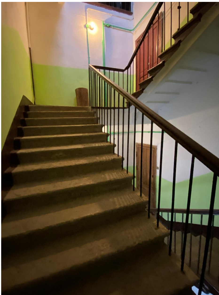
106. Лестница 4ЛК в уровне третьего этажа
