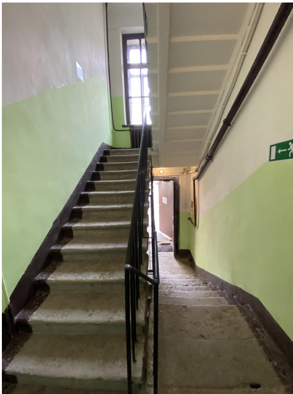
58. Лестница 2 ЛК в уровне первого этажа
