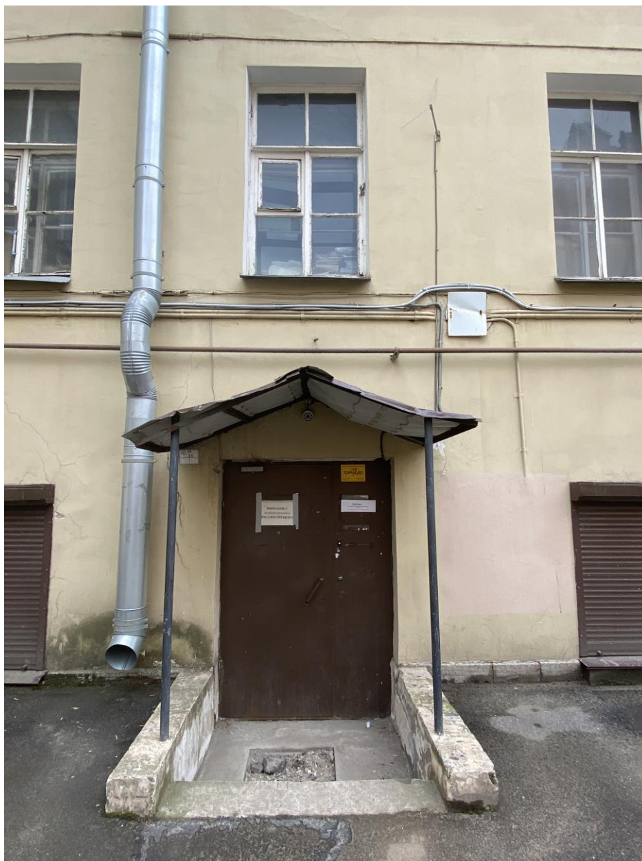
22. Вход на лестницу 3 ЛК
