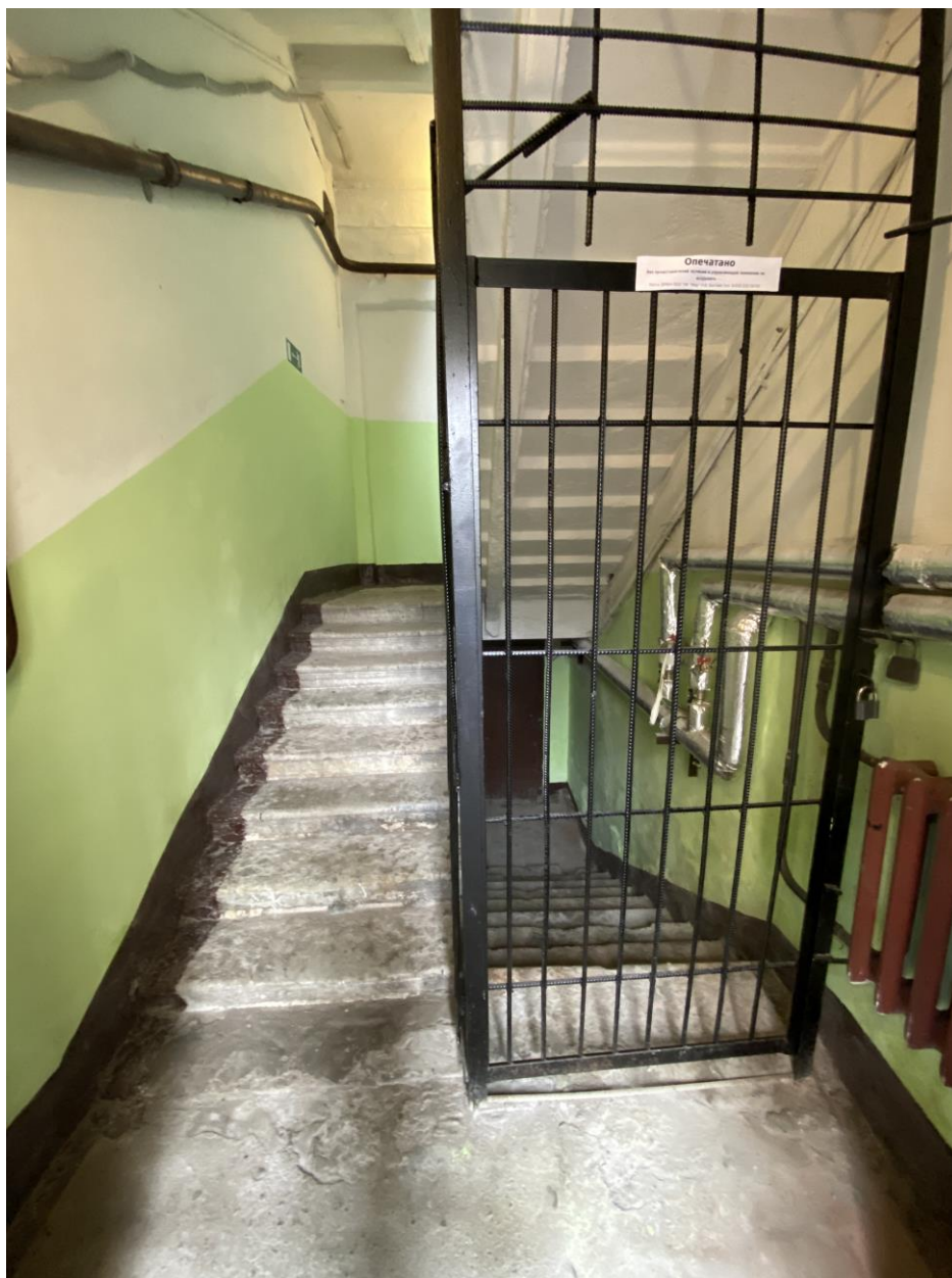
56. Лестница 2 ЛК в уровне первого этажа
