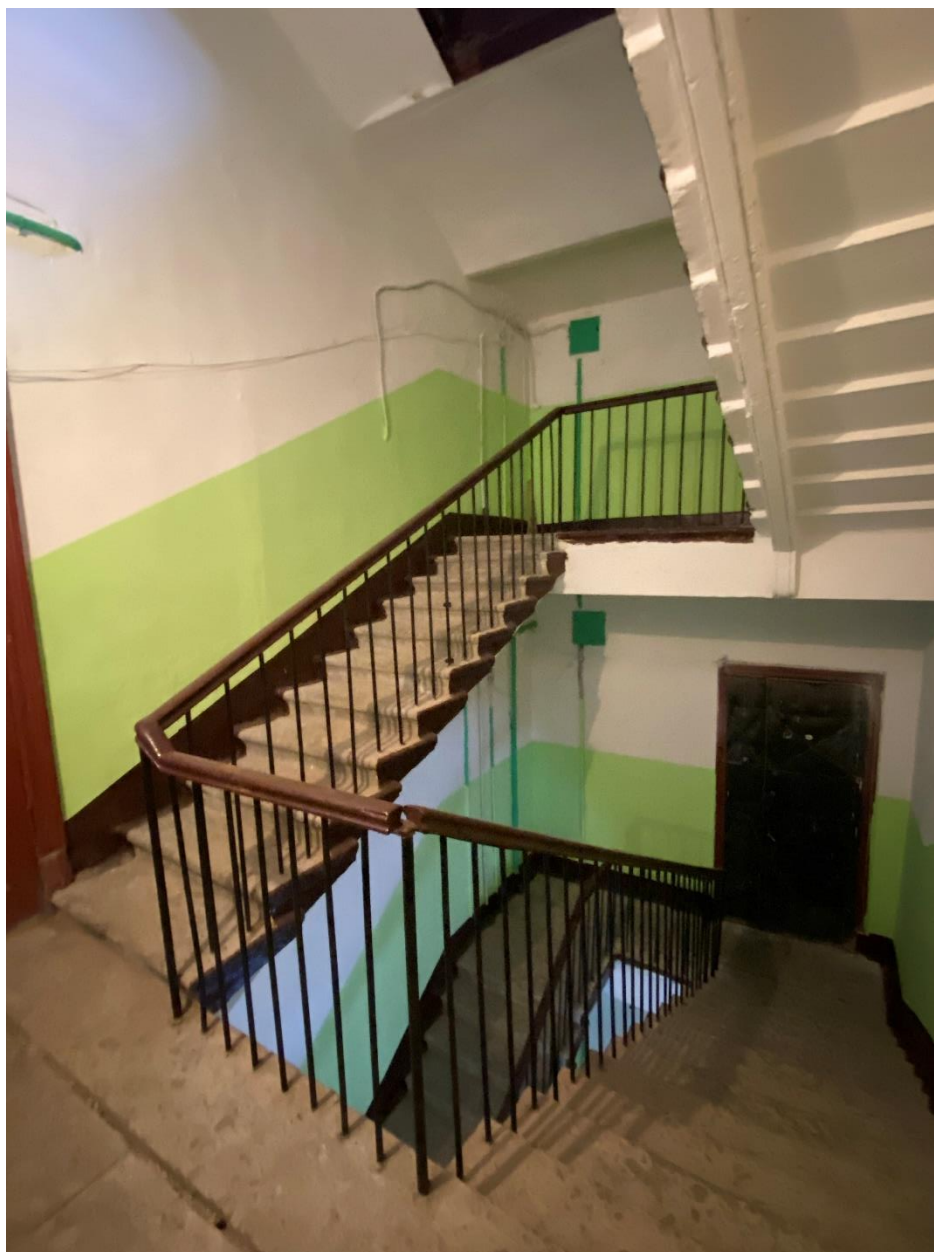
107. Лестница 4ЛК в уровне третьего этажа
