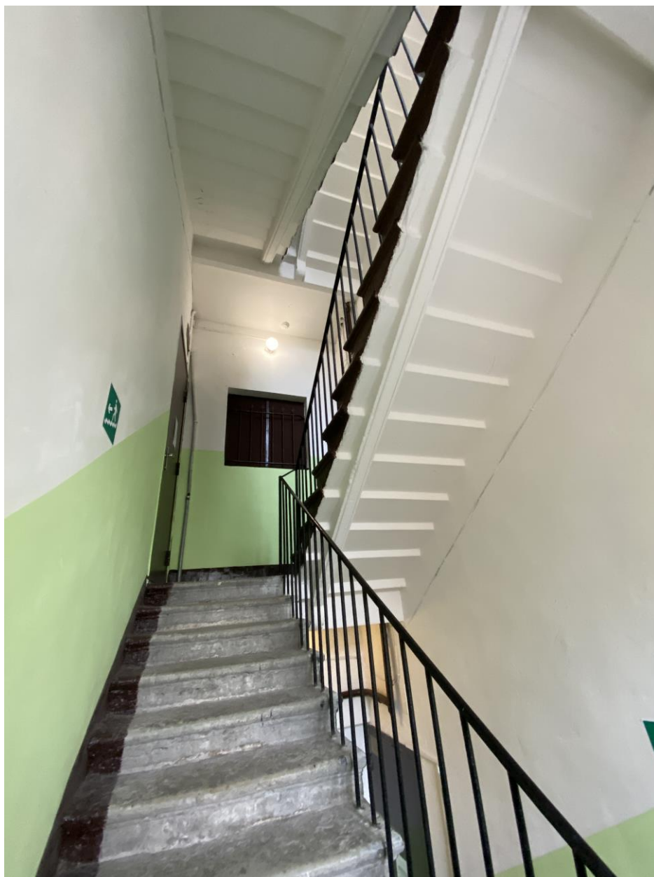
61. Лестница 2 ЛК в уровне второго этажа
