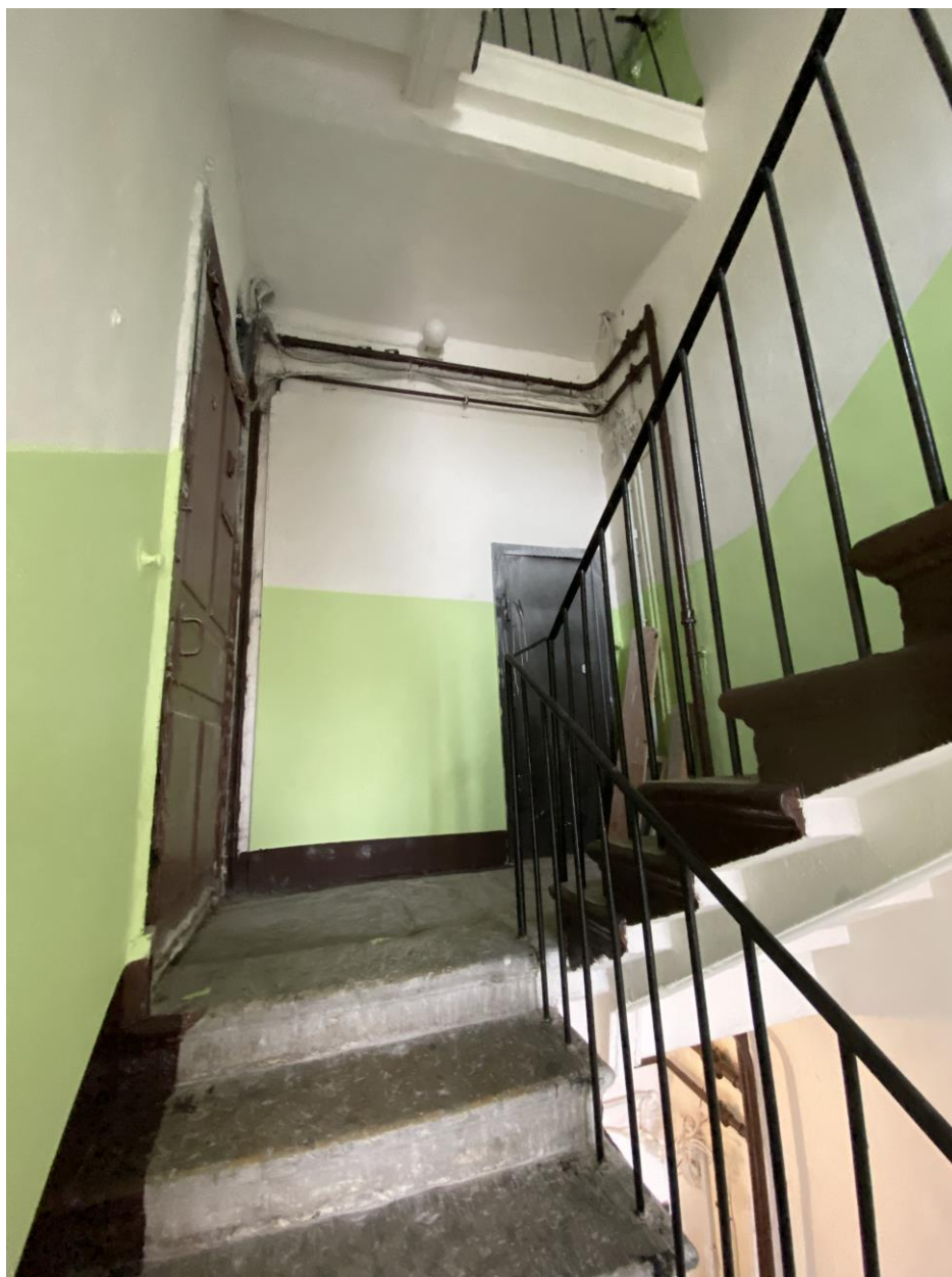
68. Лестница 2 ЛК в уровне четвертого этажа
