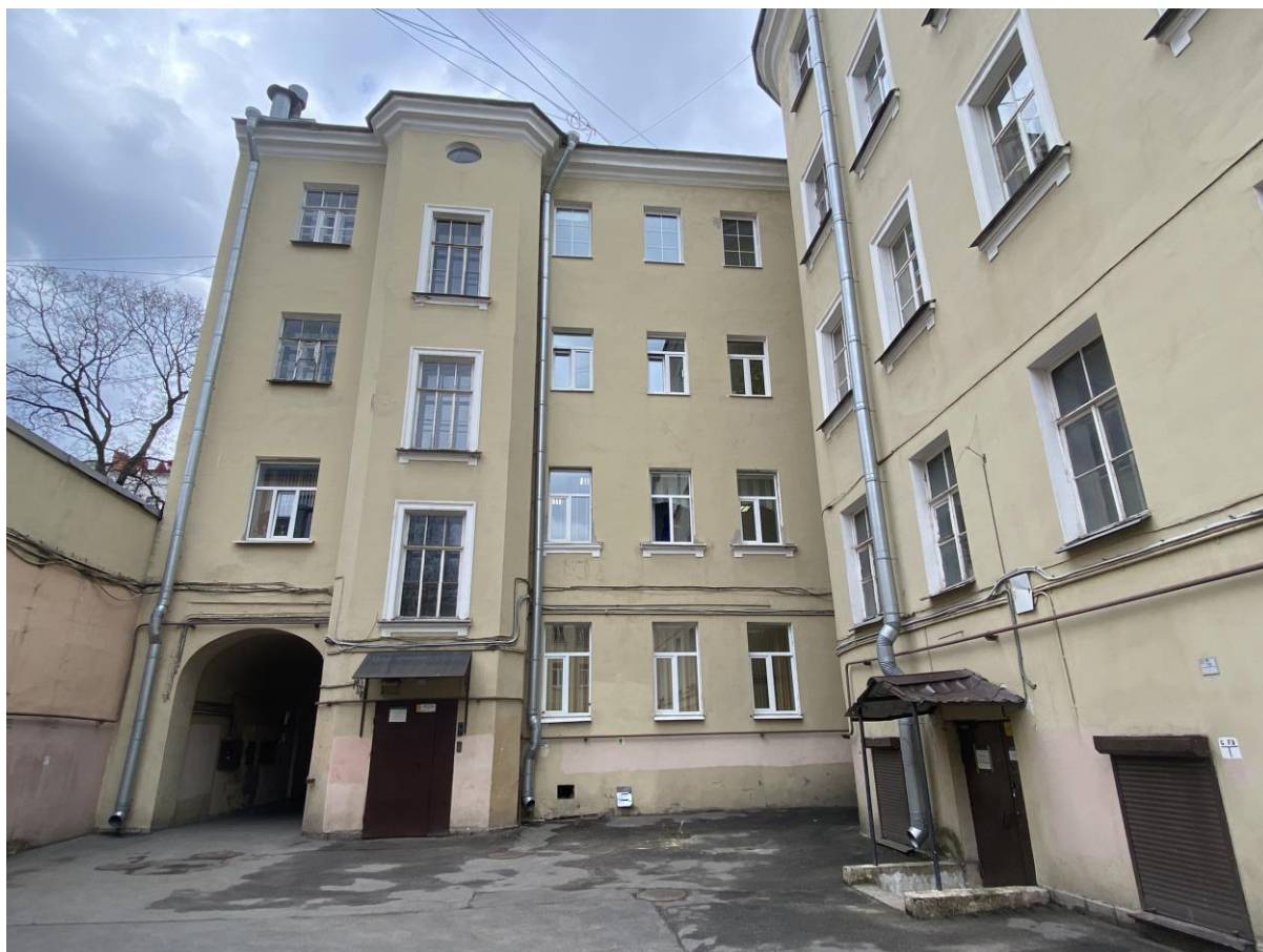
14. Дворовой фасад лицевого корпуса
