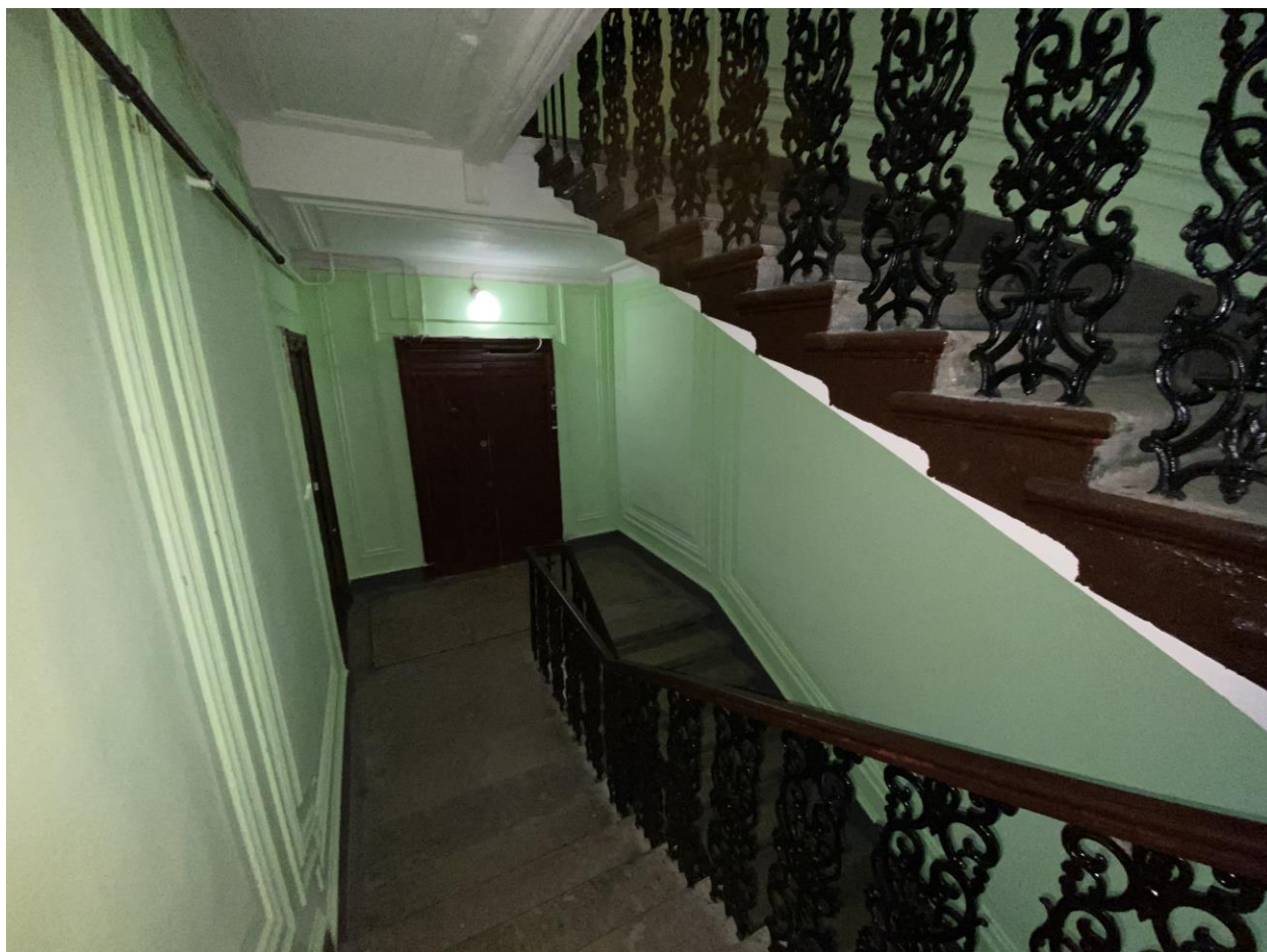
48. Лестница 1 ЛК в уровне третьего этажа
