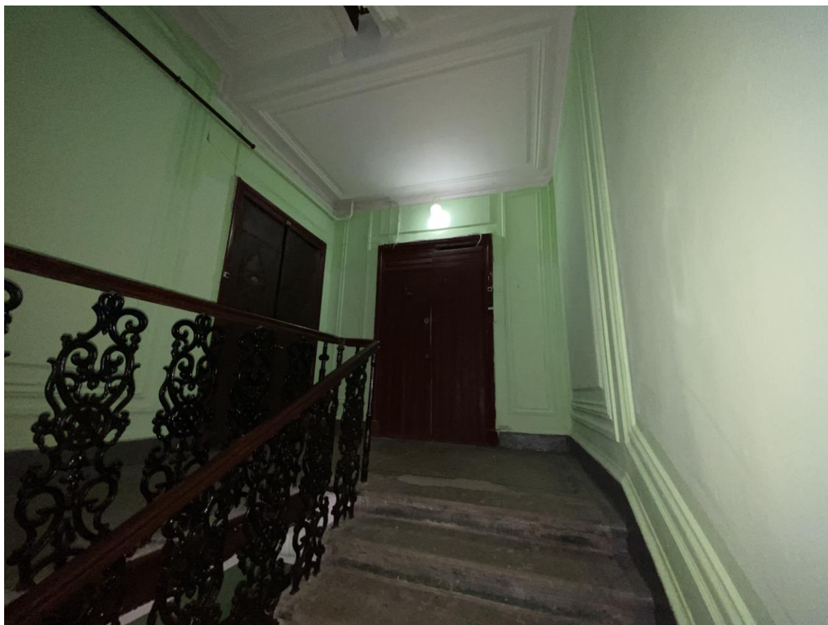
46. Лестница 1 ЛК в уровне третьего этажа
