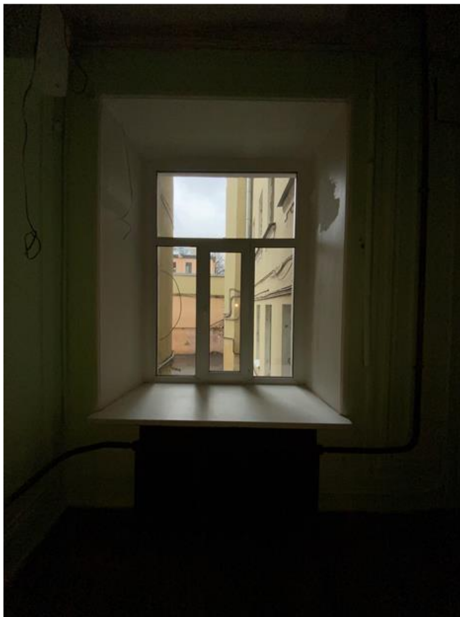
40. Оконный проем на лестнице 1 ЛК
