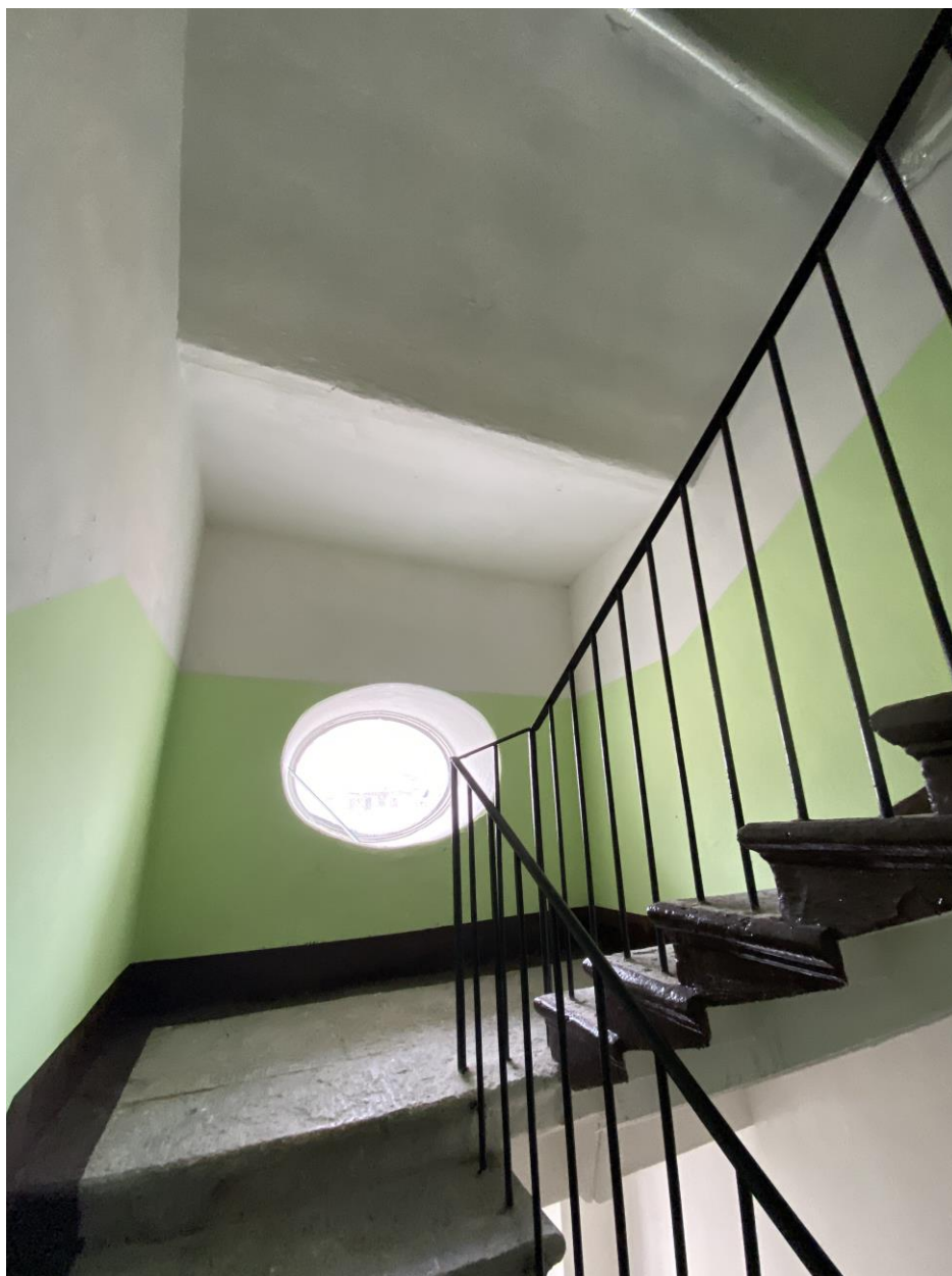
69. Лестница 2 ЛК в уровне чердака
