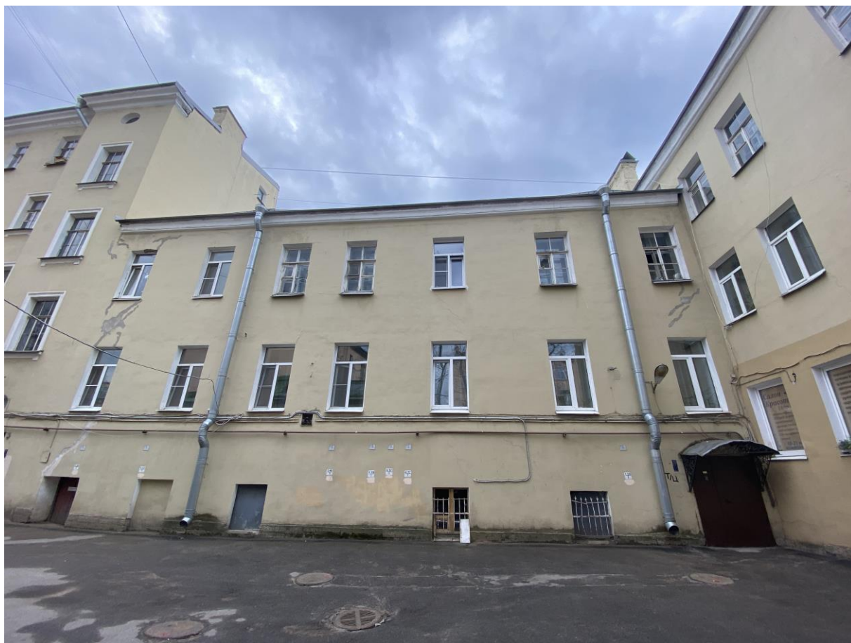
16. Фасад двухэтажного дворового флигеля
