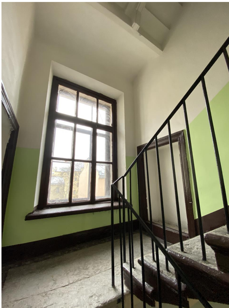
67. Лестница 2 ЛК в уровне третьего этажа
