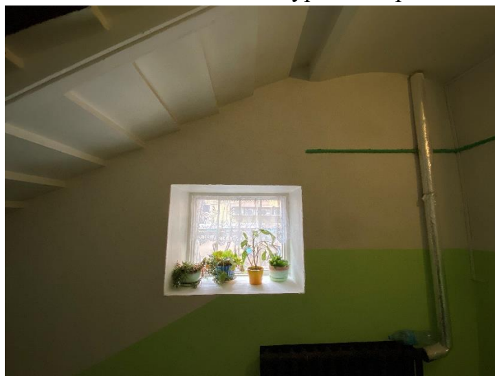
101. Оконный проем на лестнице 4ЛК
