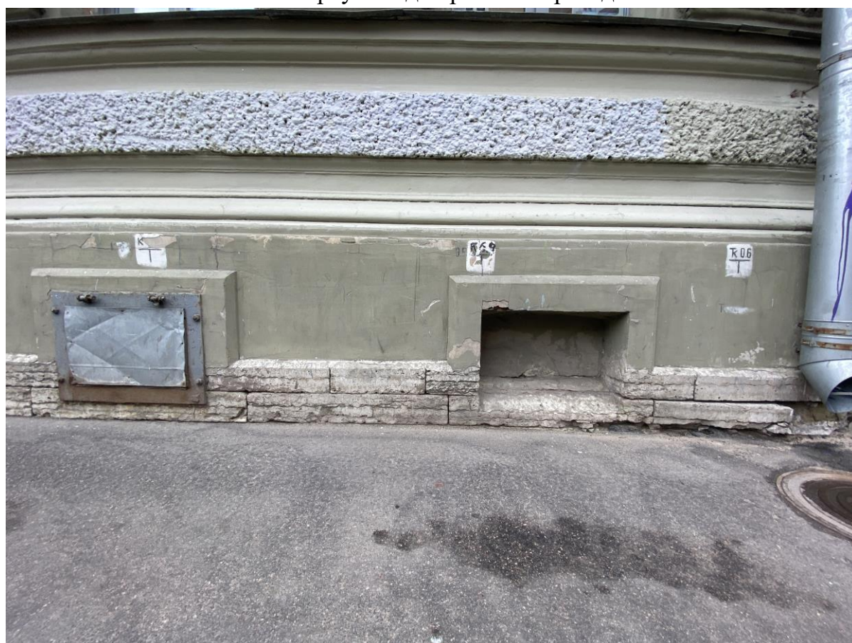
4. Фрагмент цоколя лицевого фасада
