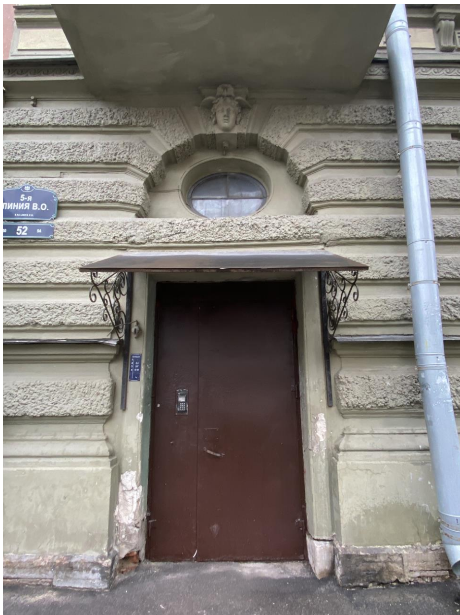
11. Вход на лестницу 1ЛК
