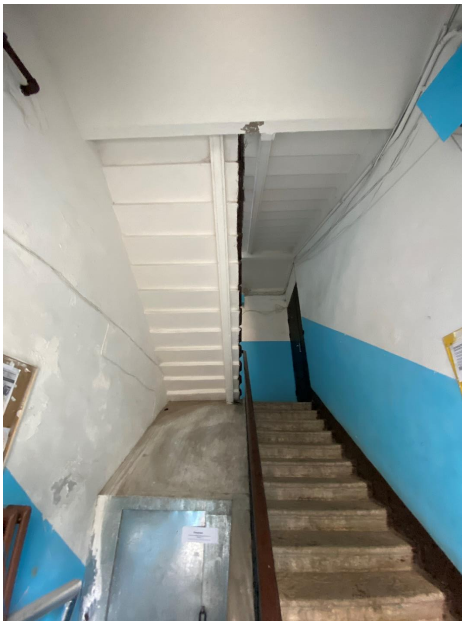
73. Лестница ЗЛК в уровне первого этажа
