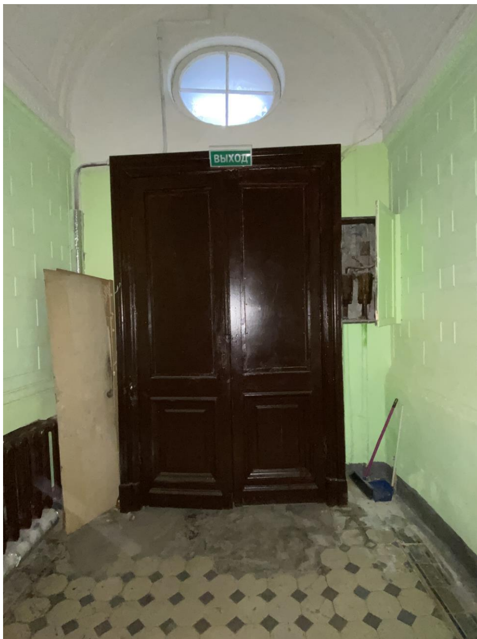
30. Вид на двери тамбура из вестибюля лестницы 1ЛК
