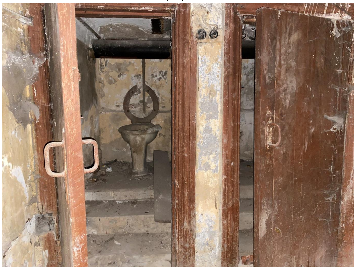
112. Интерьер цокольного этажа
