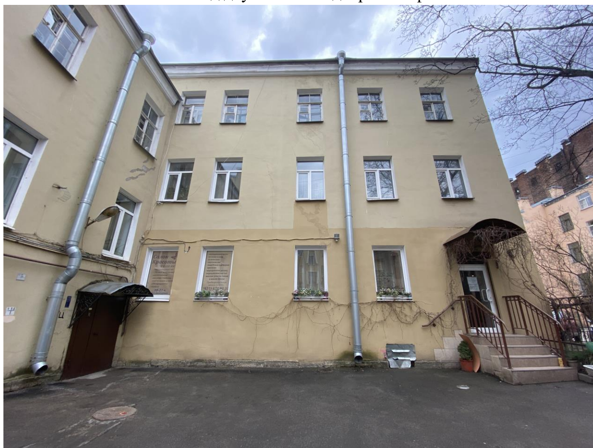
17. Фасад трехэтажного дворового флигеля
