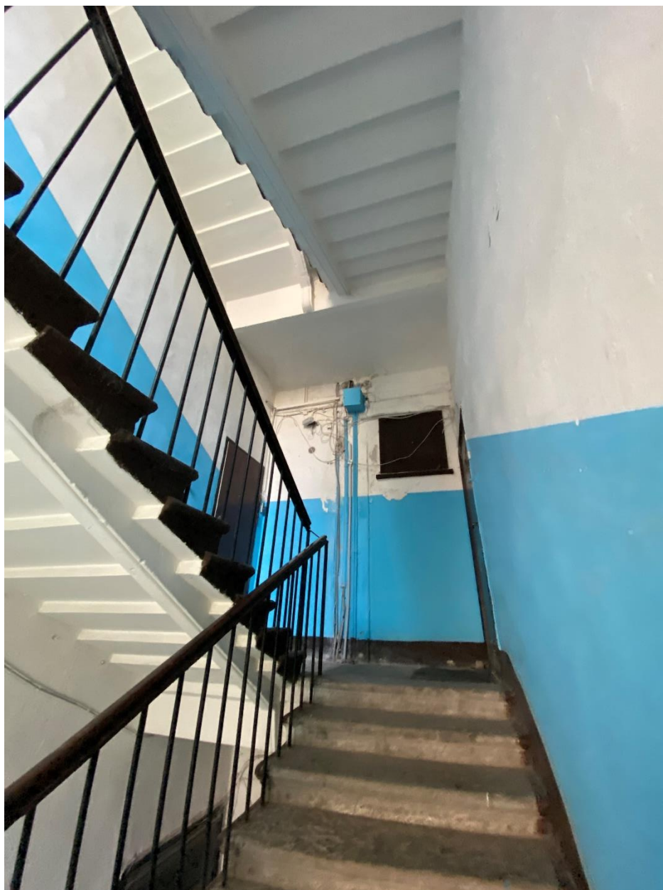
80. Лестница ЗЛК в уровне второго этажа
