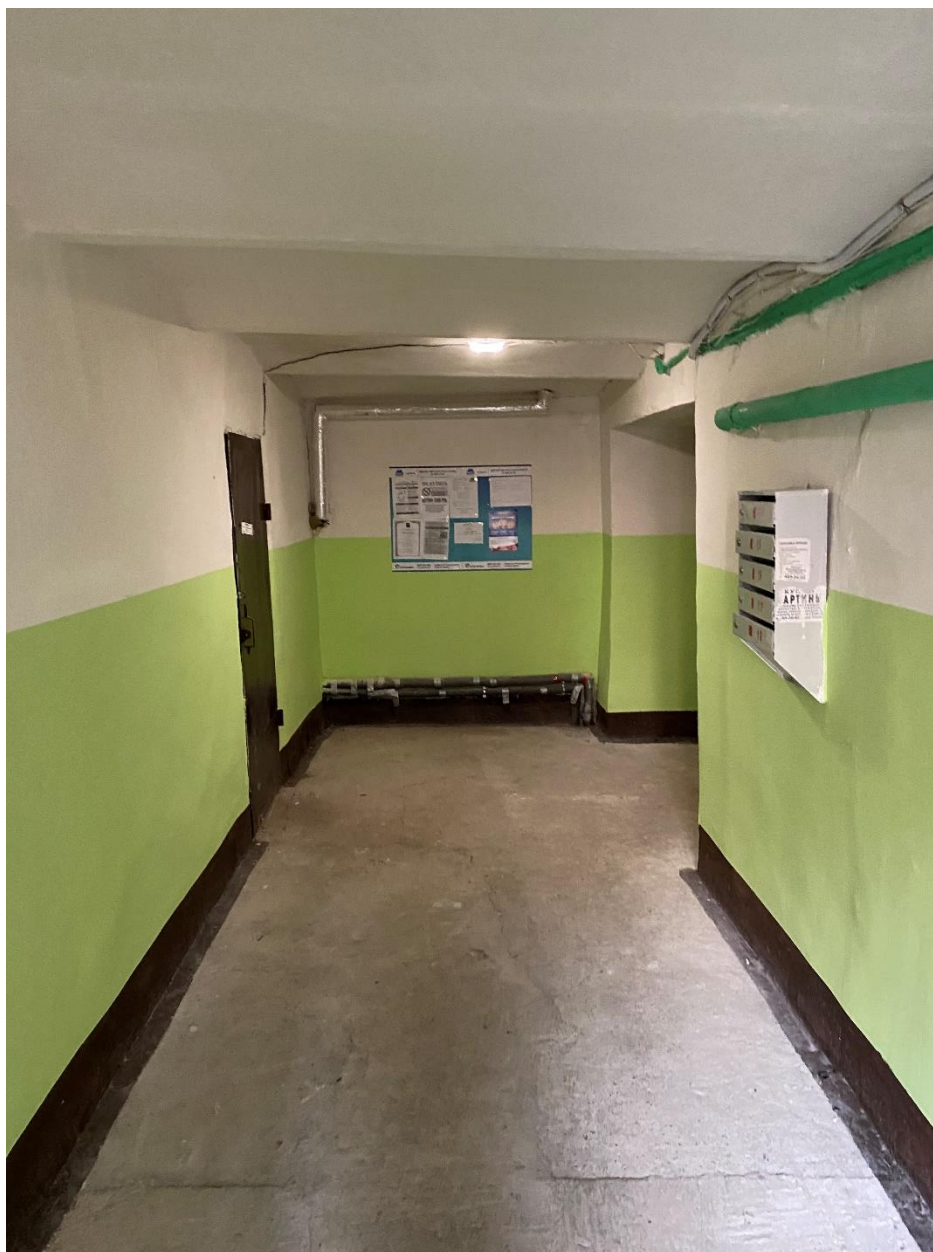
96. Лестница 4ЛК в уровне цокольного этажа
