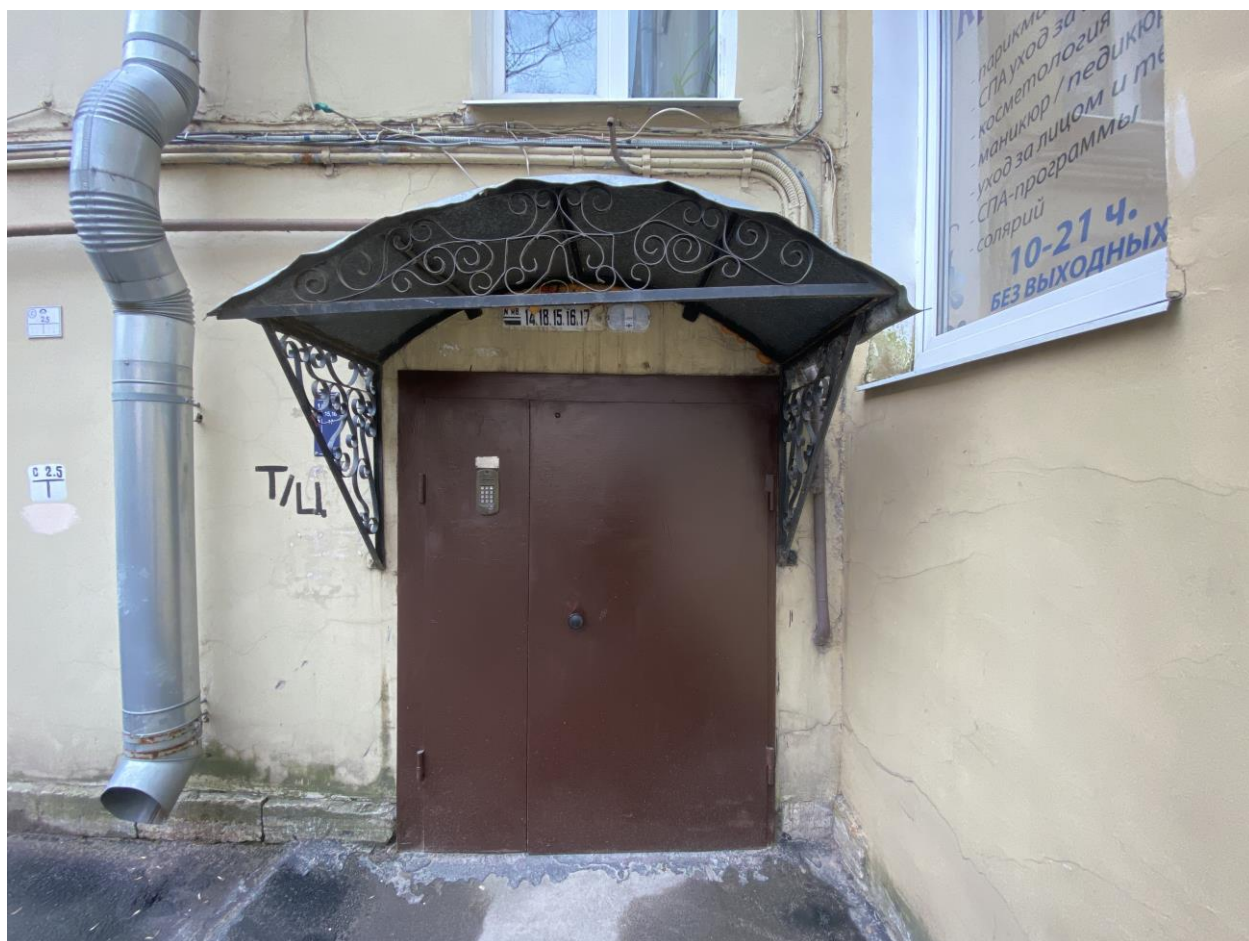
20. Вход на лестницу 4ЛК
