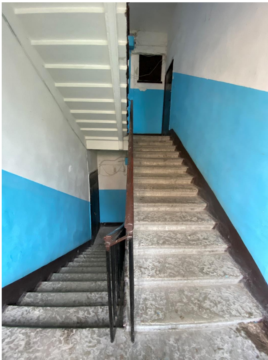
79. Лестница ЗЛК в уровне второго этажа
