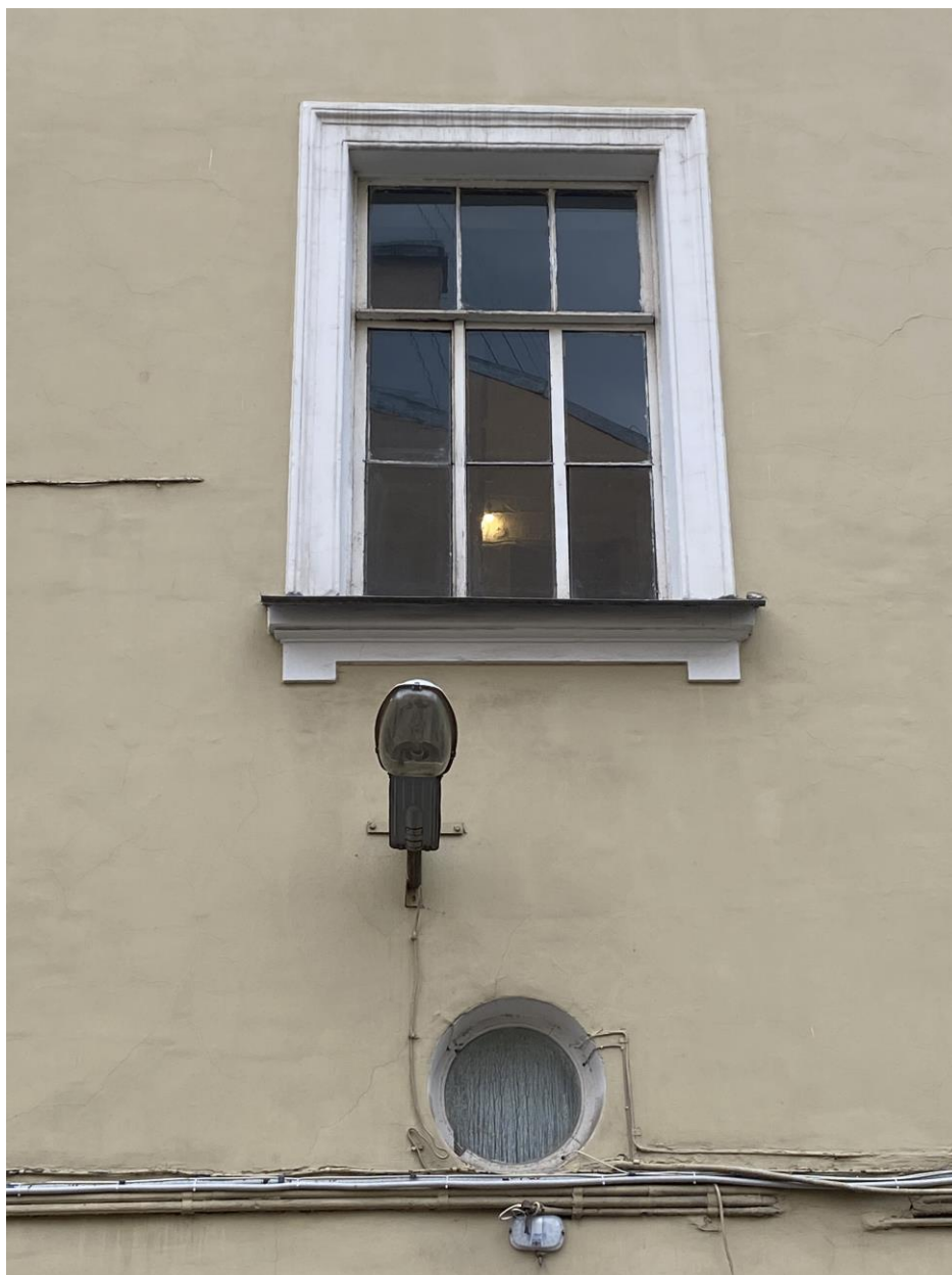
24. Оформление оконных проемов лестничного ризалита лестницы 3ЛК
