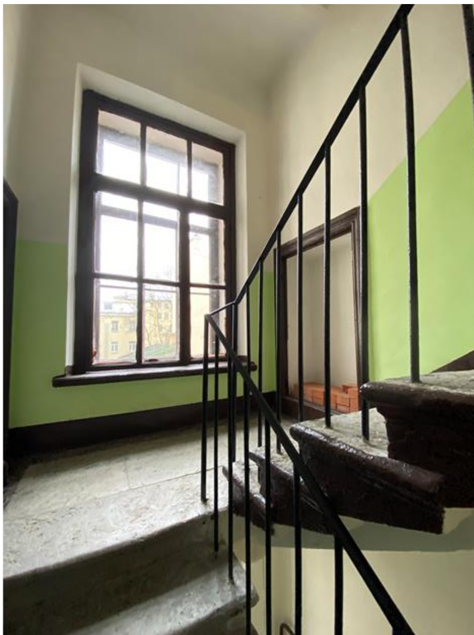
63. Лестница 2 ЛК в уровне третьего этажа
