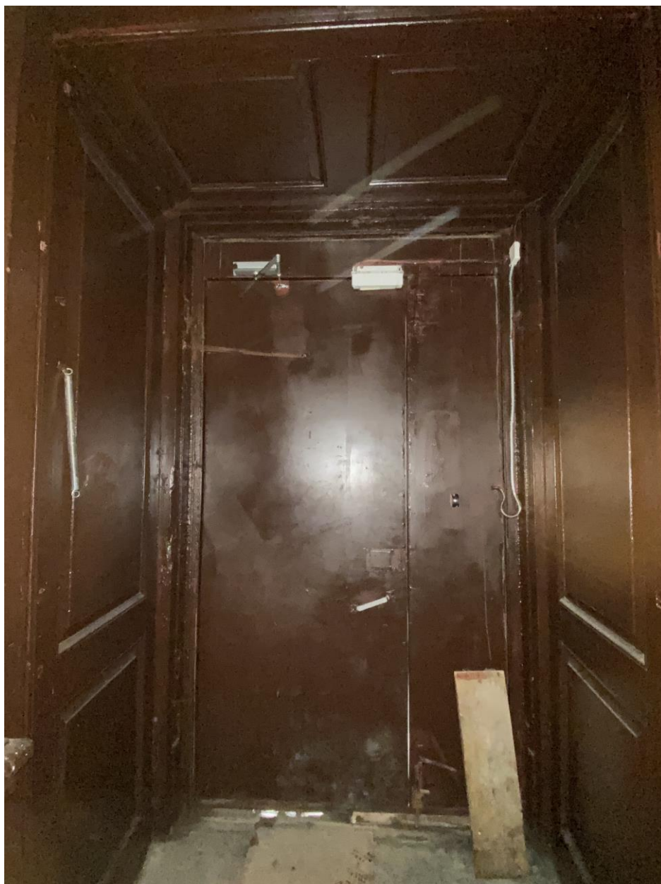
32. Вид из тамбура на входную дверь
