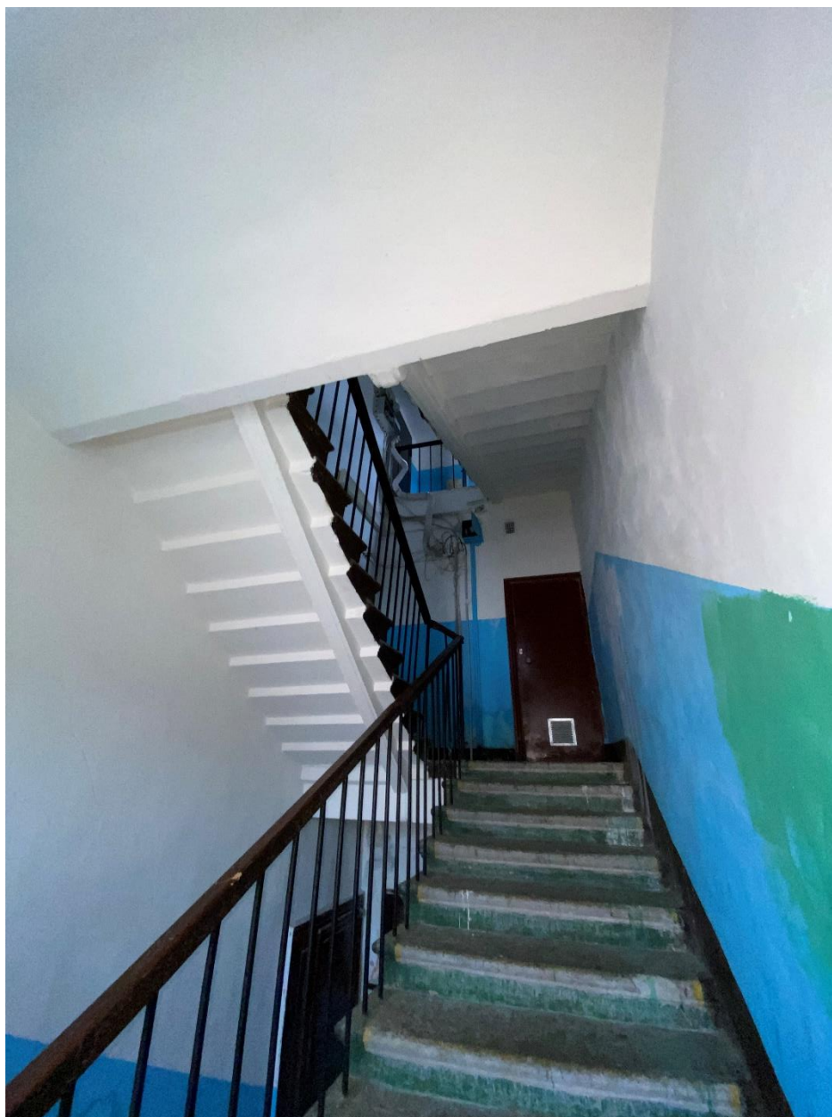
89. Лестница ЗЛК в уровне четвертого этажа
