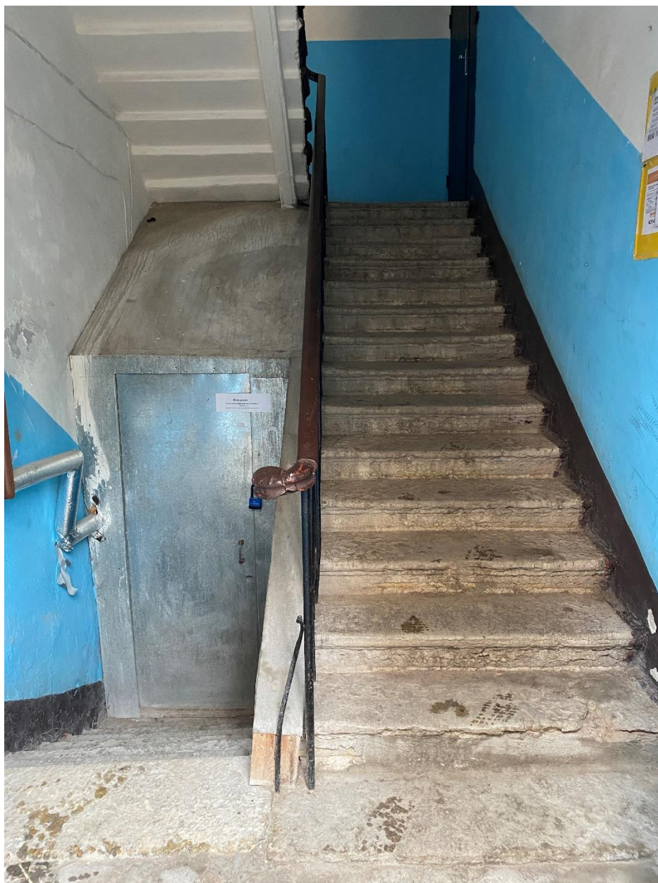
72. Лестница ЗЛК в уровне первого этажа
