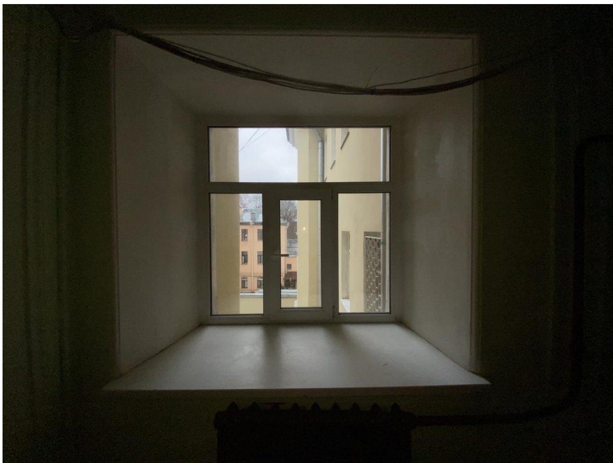
50. Оконный проем в уровне третьего этажа
