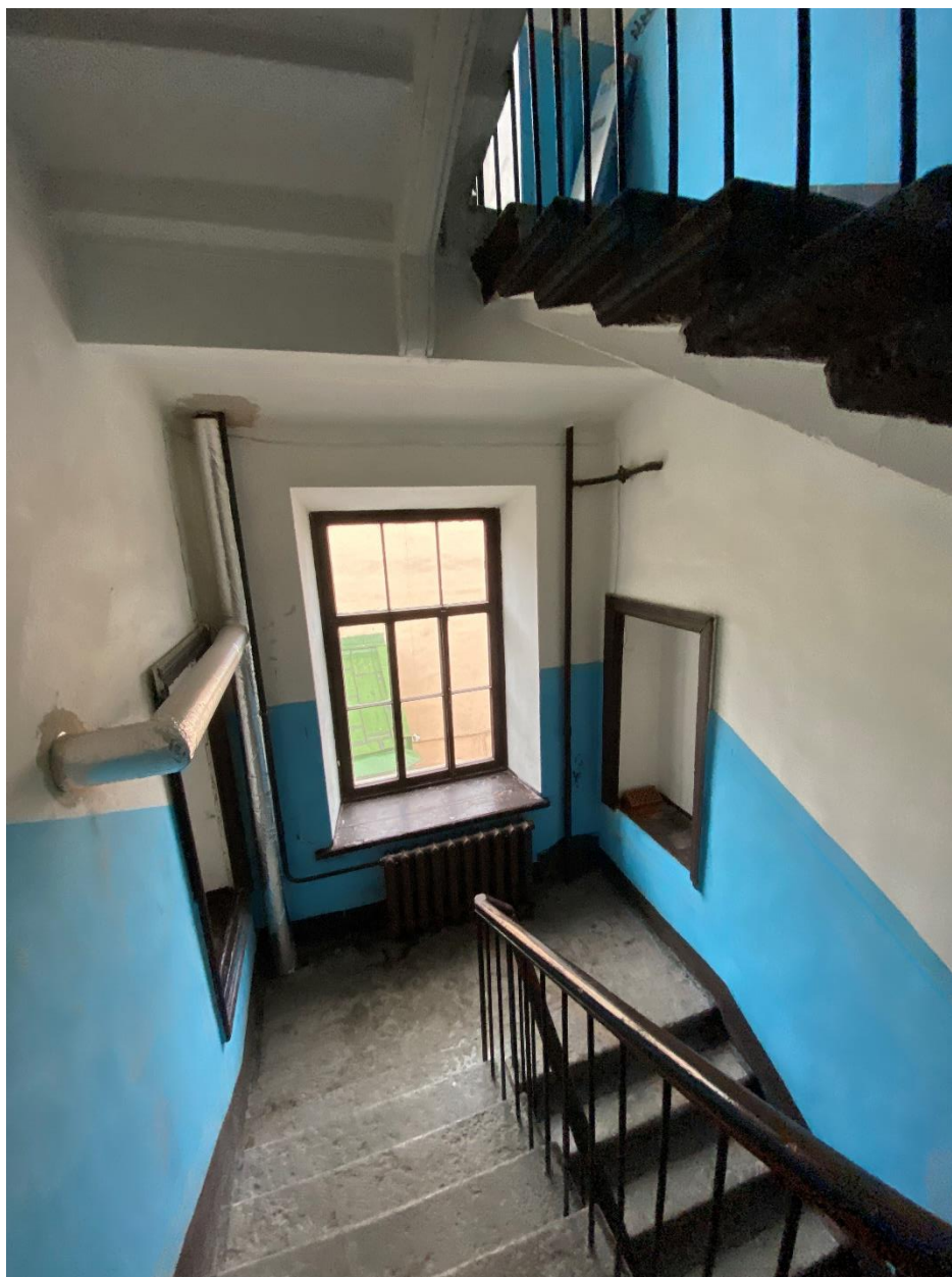
82. Лестница ЗЛК в уровне третьего этажа
