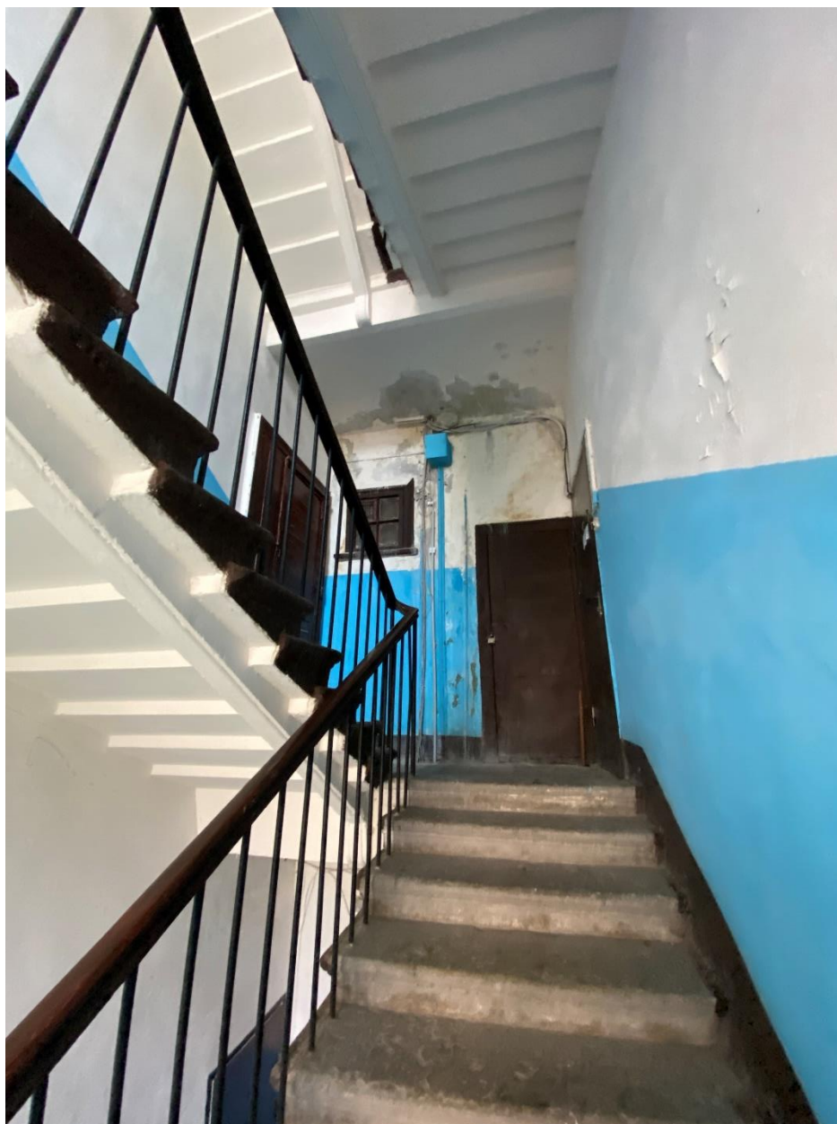
83. Лестница ЗЛК в уровне третьего этажа
