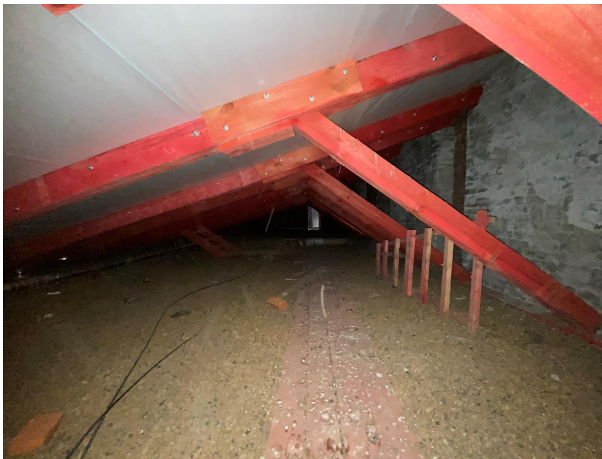
87. Интерьер чердачного помещения
