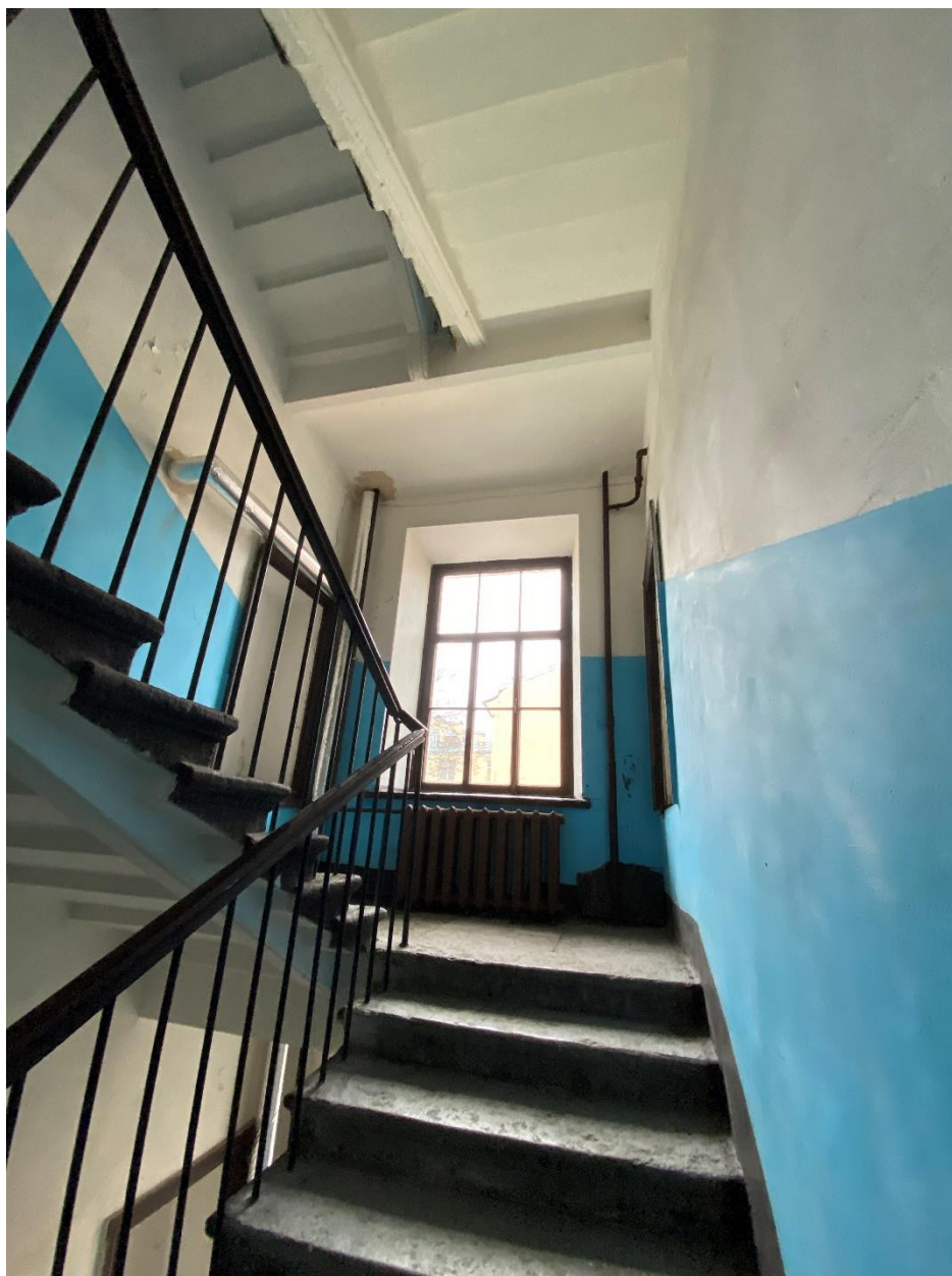
81. Лестница ЗЛК в уровне третьего этажа
