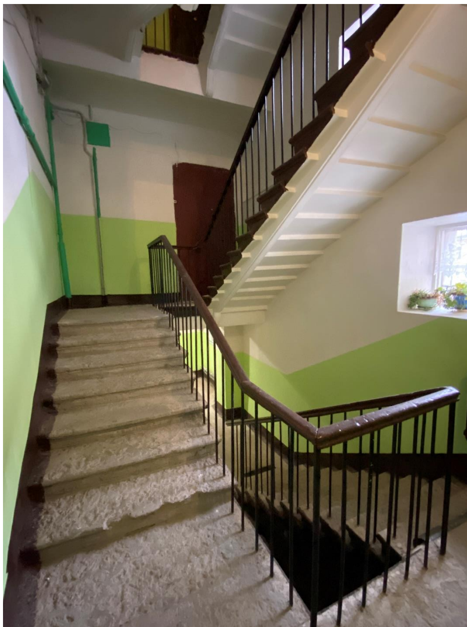
100. Лестница 4ЛК в уровне первого этажа
