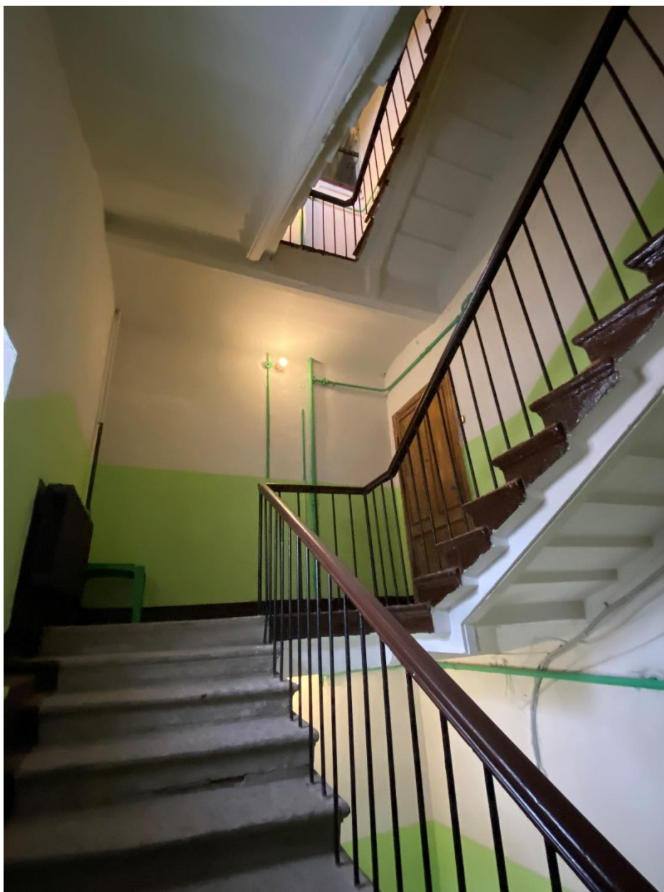
103. Лестница 4ЛК в уровне второго этажа
