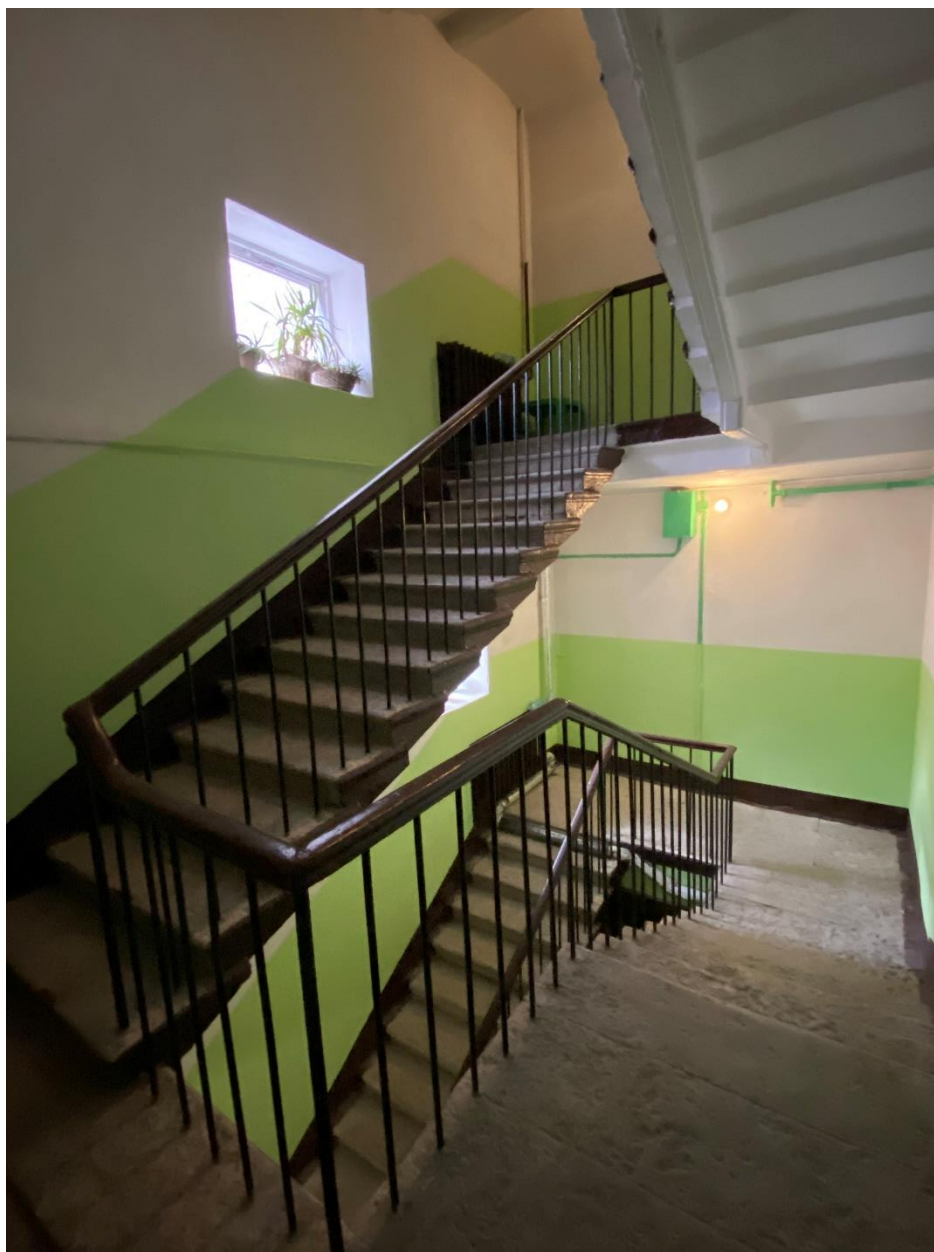
102. Лестница 4ЛК в уровне первого этажа
