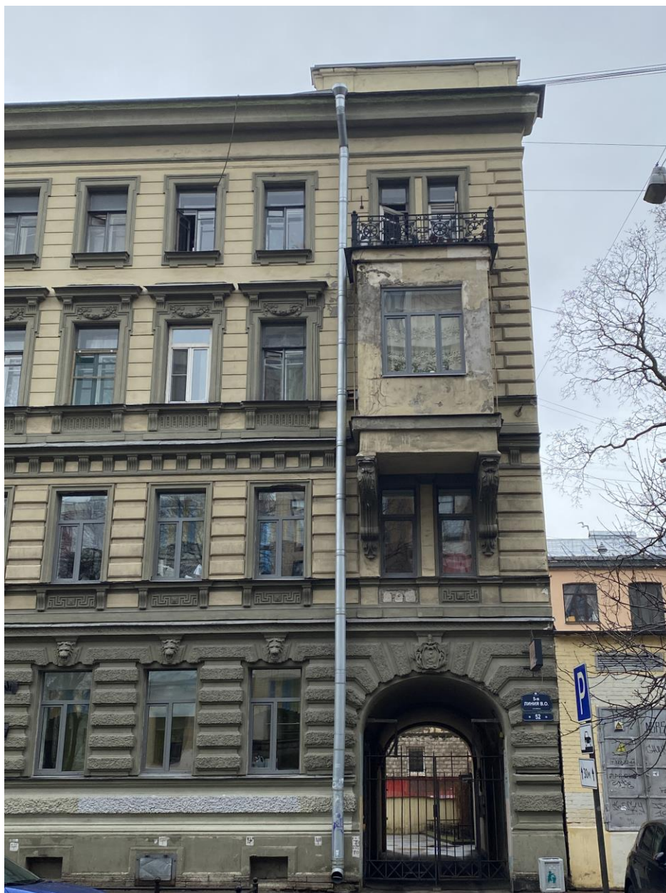
10. Фрагмент правой части лицевого фасада
