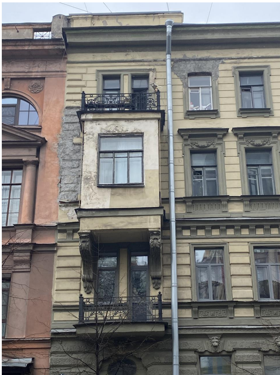
9. Фрагмент левой части лицевого фасада
