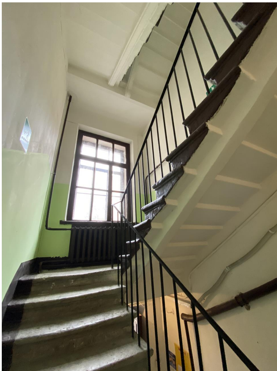
59. Лестница 2 ЛК в уровне второго этажа
