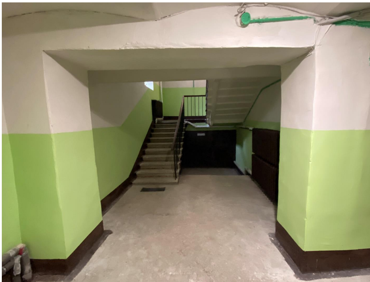
97. Лестница 4ЛК в уровне цокольного этажа
