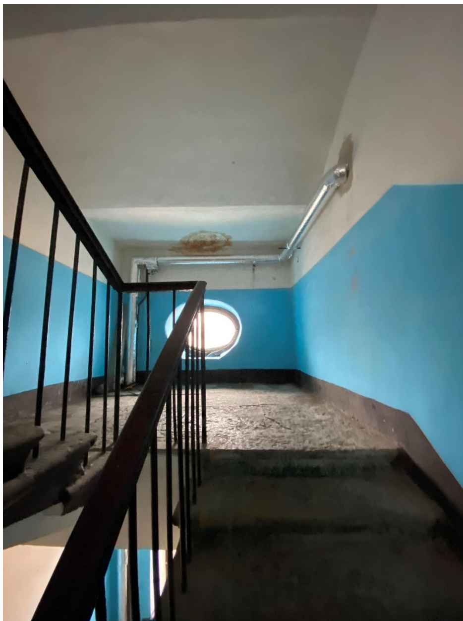
90. Лестница ЗЛК в уровне чердака
