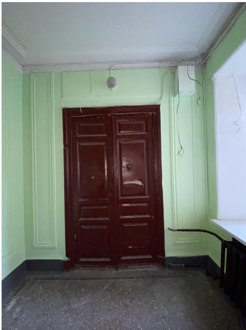
41. Дверь в квартиру №2
