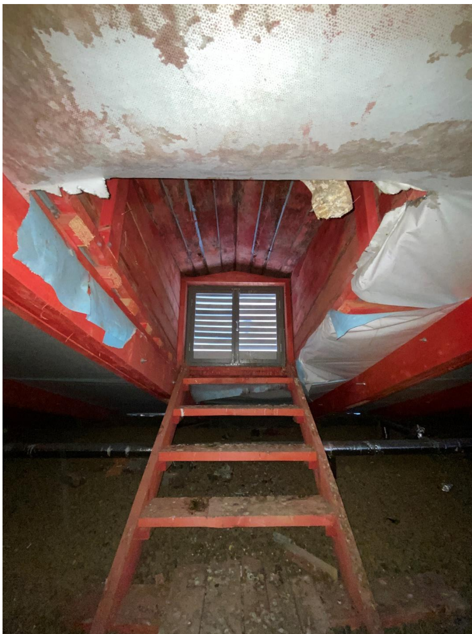
86. Интерьер чердачного помещения
