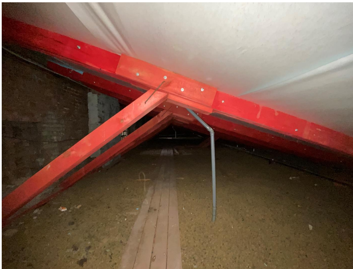
84. Интерьер чердачного помещения
