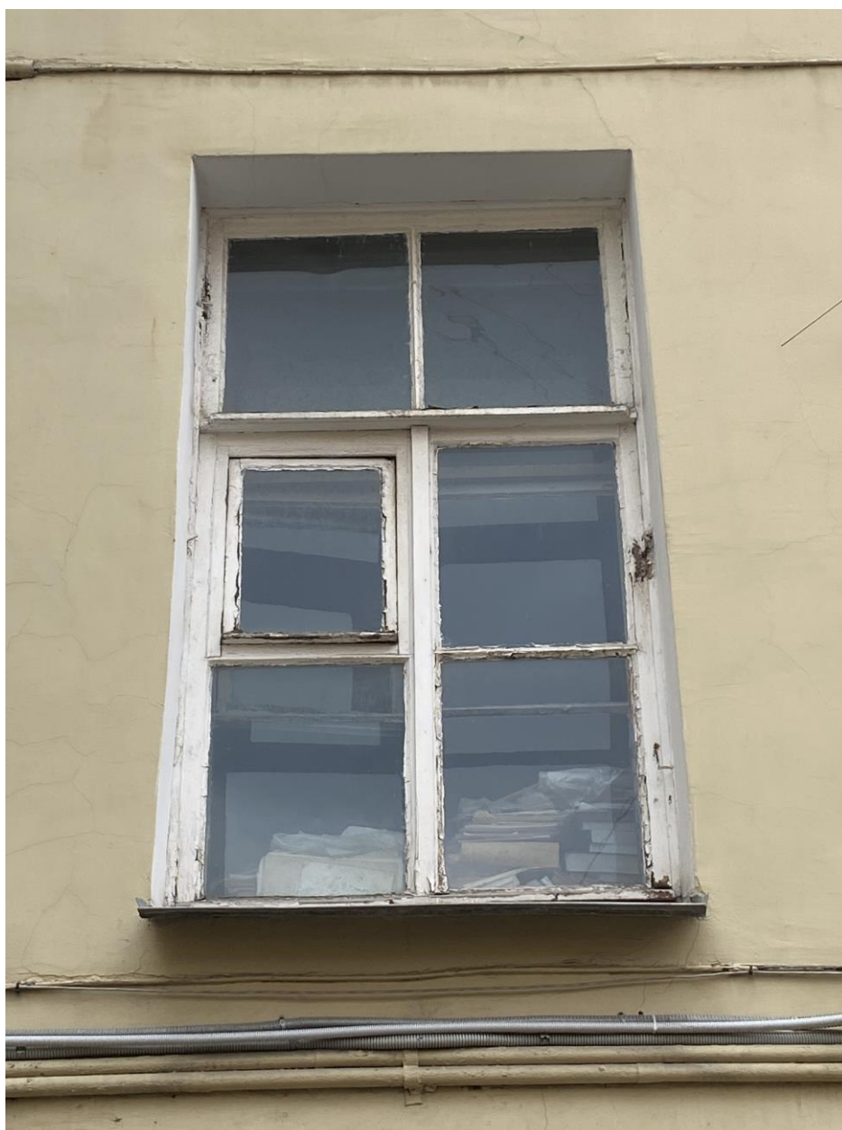
23. Заполнение оконного проема
