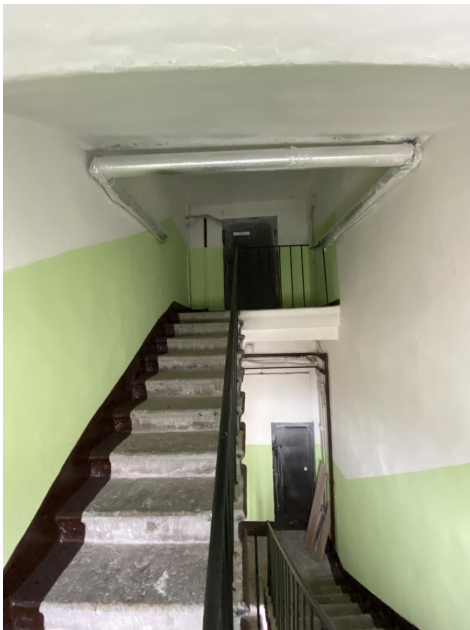
70. Лестница 2 ЛК в уровне чердака
