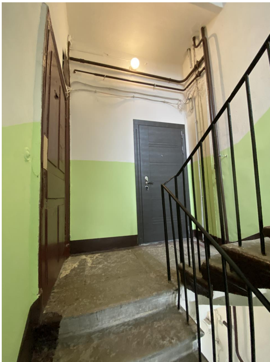
65. Лестница 2 ЛК в уровне третьего этажа
