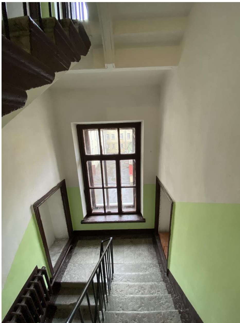
64. Лестница 2 ЛК в уровне третьего этажа
