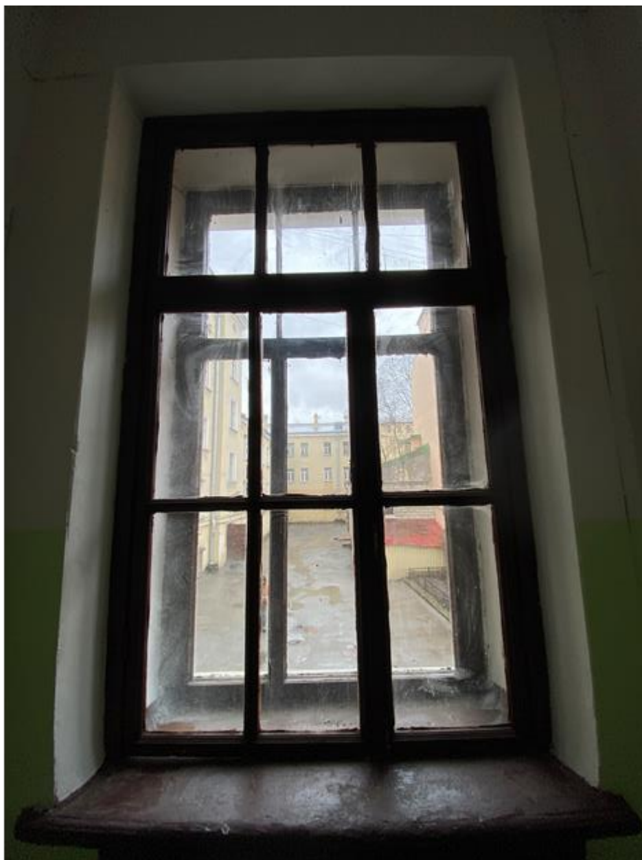
60. Оконный проем лестницы 2 ЛК
