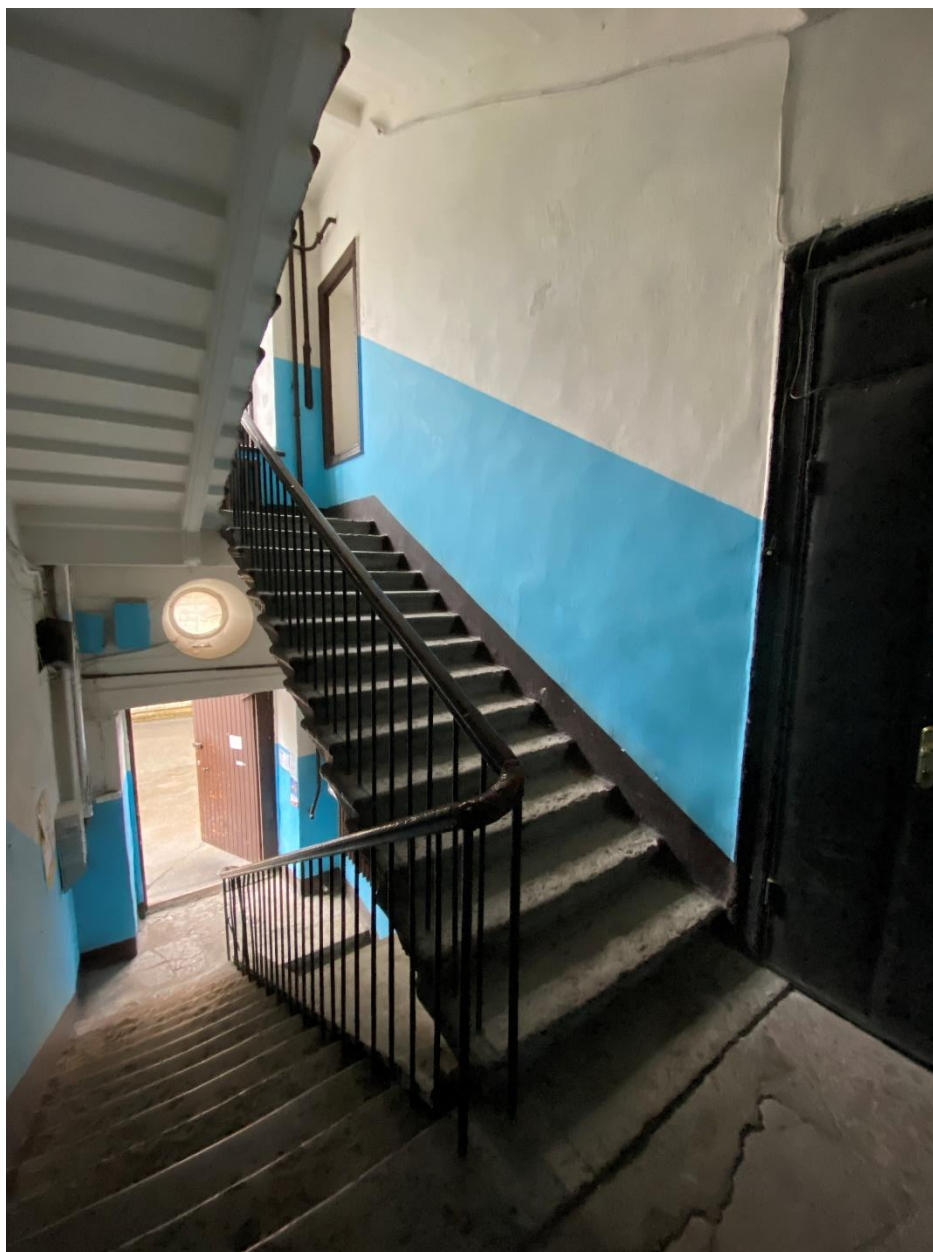
76. Лестница ЗЛК в уровне первого этажа
