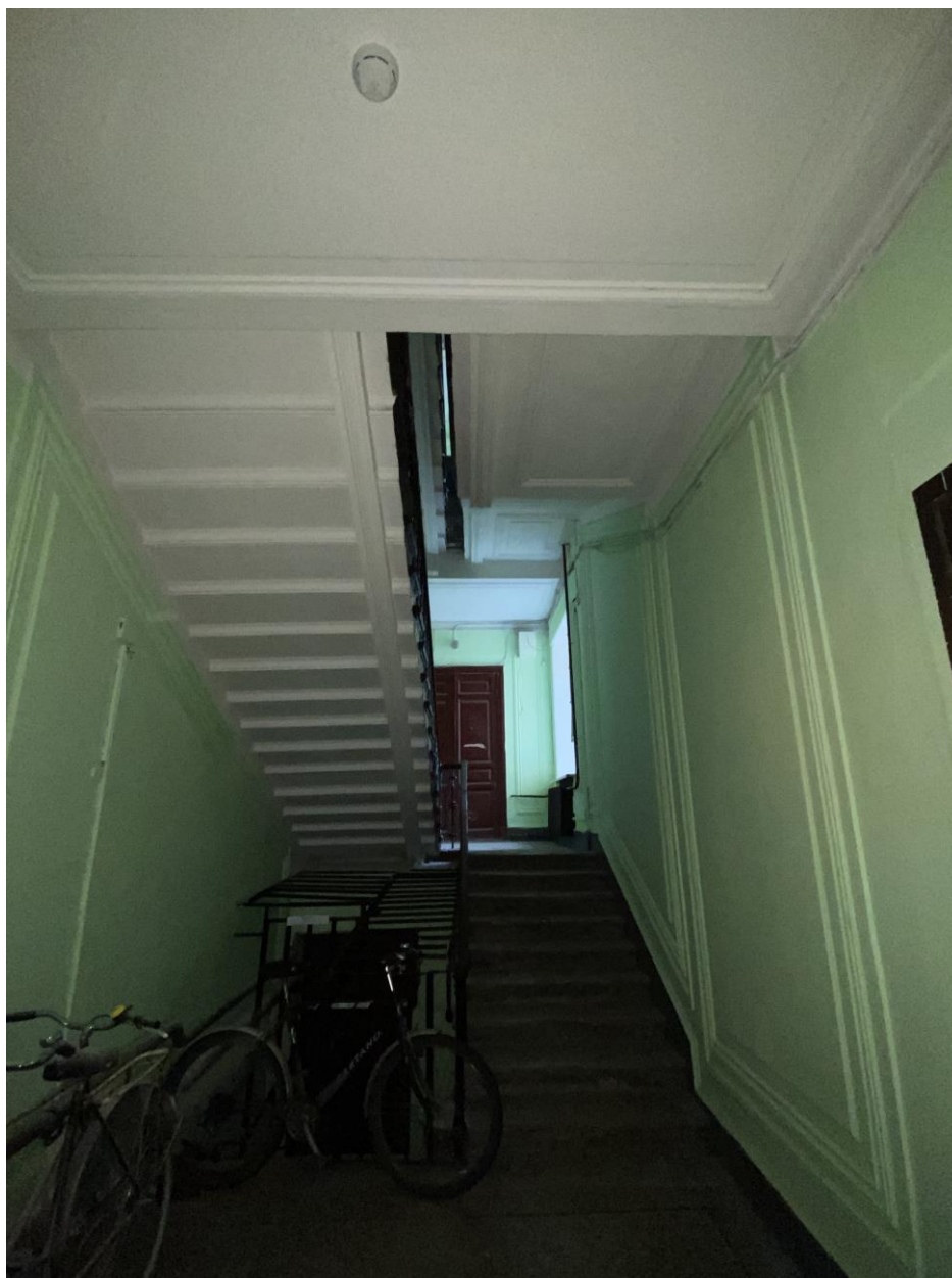
37. Лестница 1ЛК в уровне первого этажа
