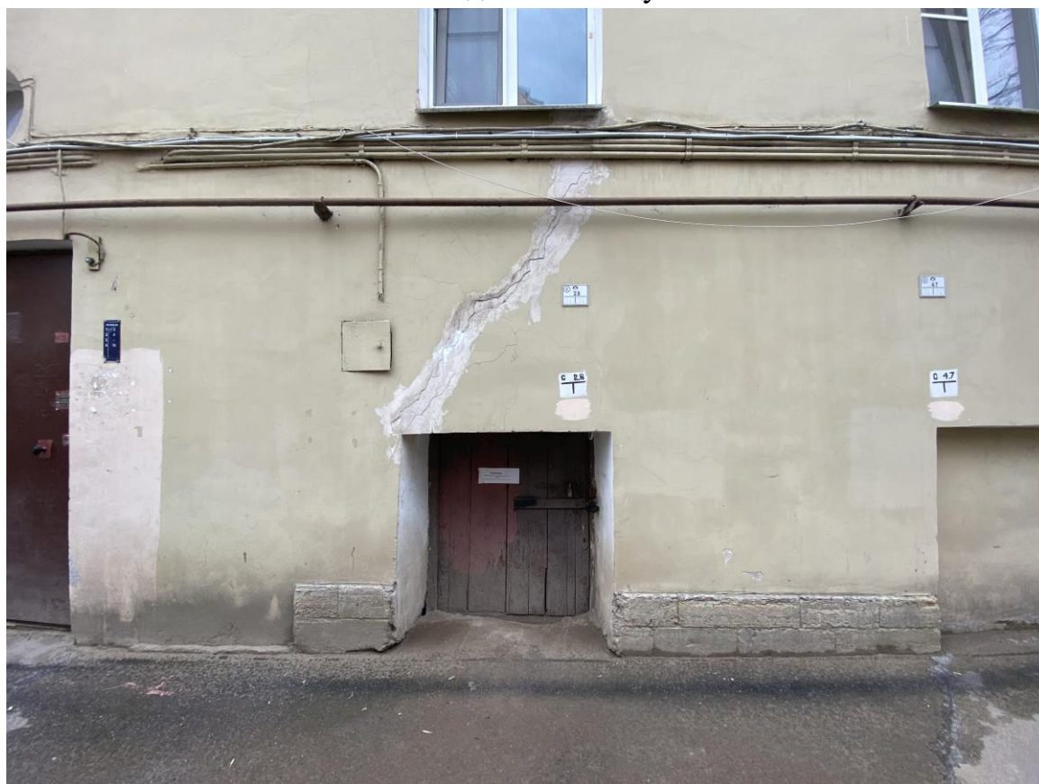
21. Фрагмент цоколя дворового флигеля
