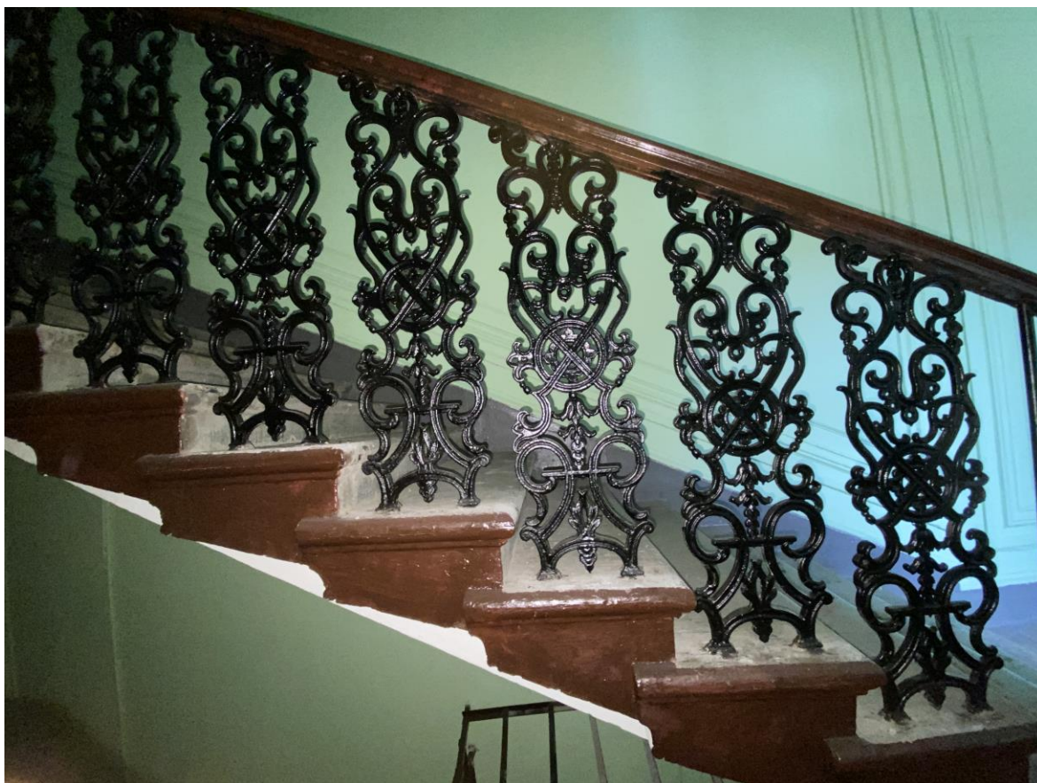
38.Перила и ограждение лестницы 1ЛК
