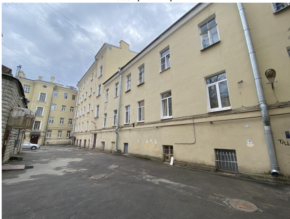
19. Вид двора с юго-запада
