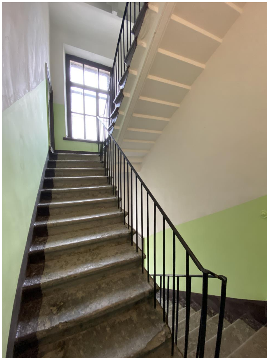
66. Лестница 2 ЛК в уровне четвертого этажа
