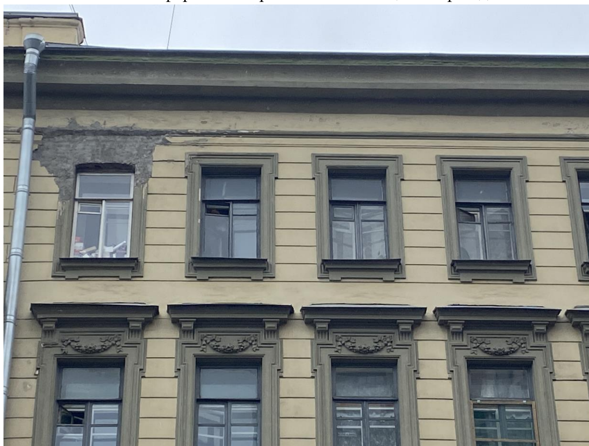
8. Оформление четвертого этажа лицевого фасада
