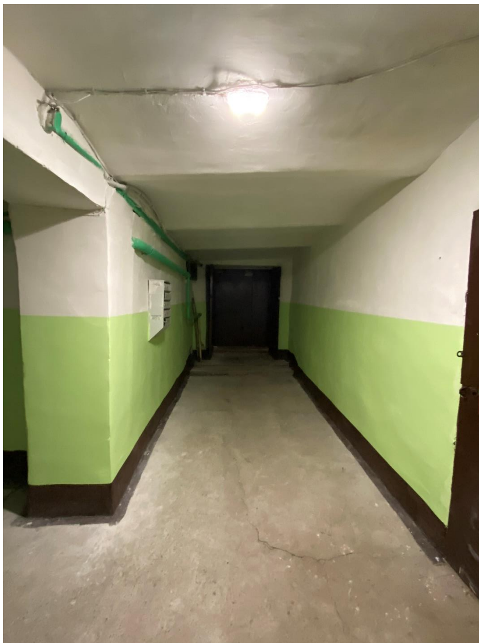
98. Лестница 4ЛК в уровне цокольного этажа
