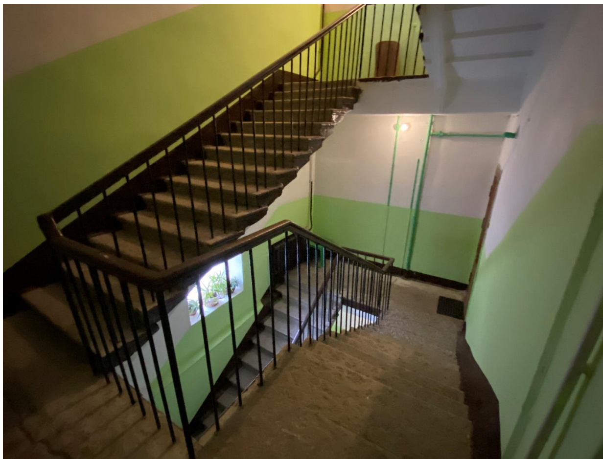
105. Лестница 4ЛК в уровне второго этажа
