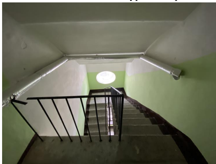
71. Лестница 2 ЛК в уровне чердака
