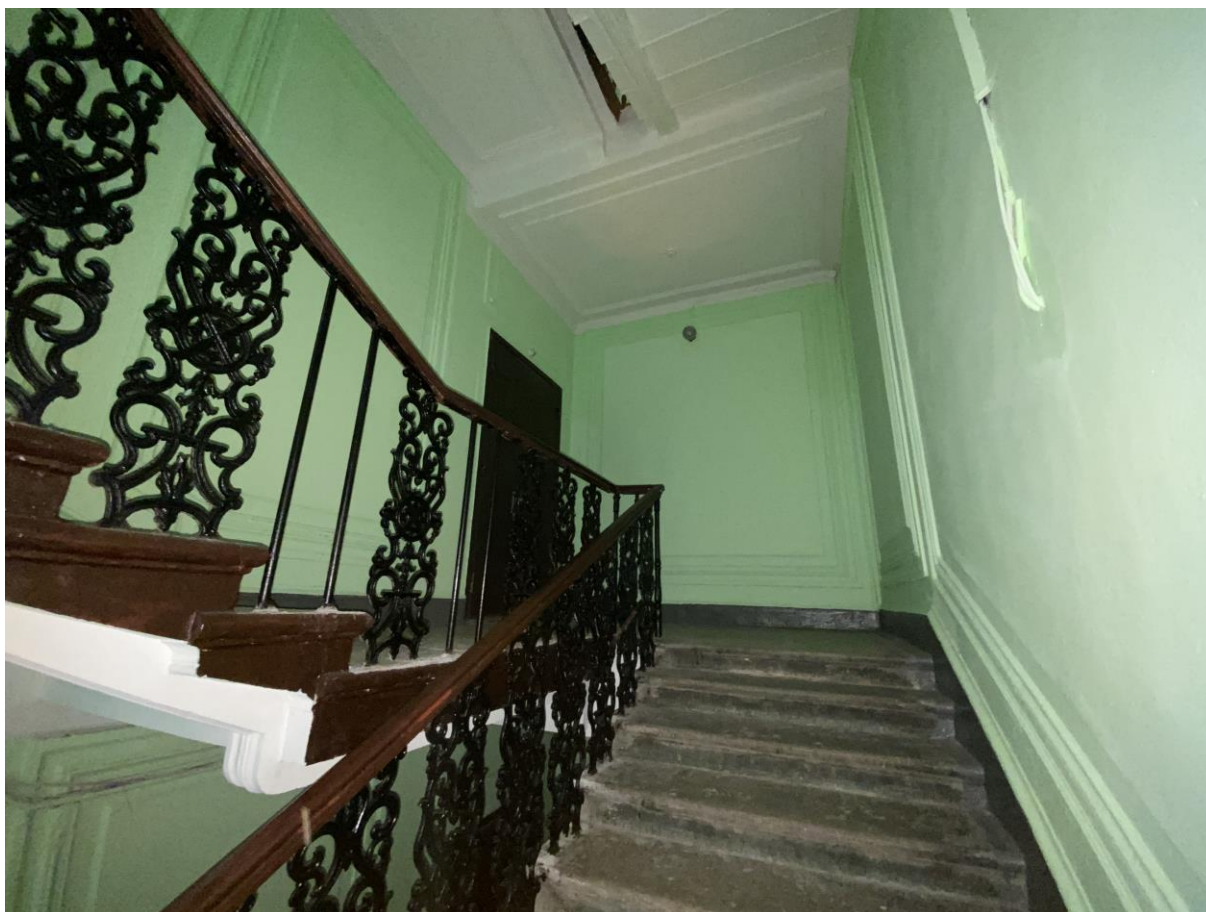
42. Лестница 1 ЛК в уровне второго этажа
