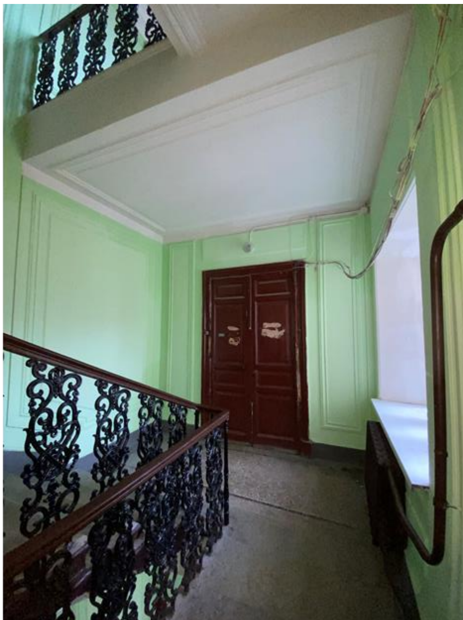
49. Лестница 1 ЛК в уровне третьего этажа
