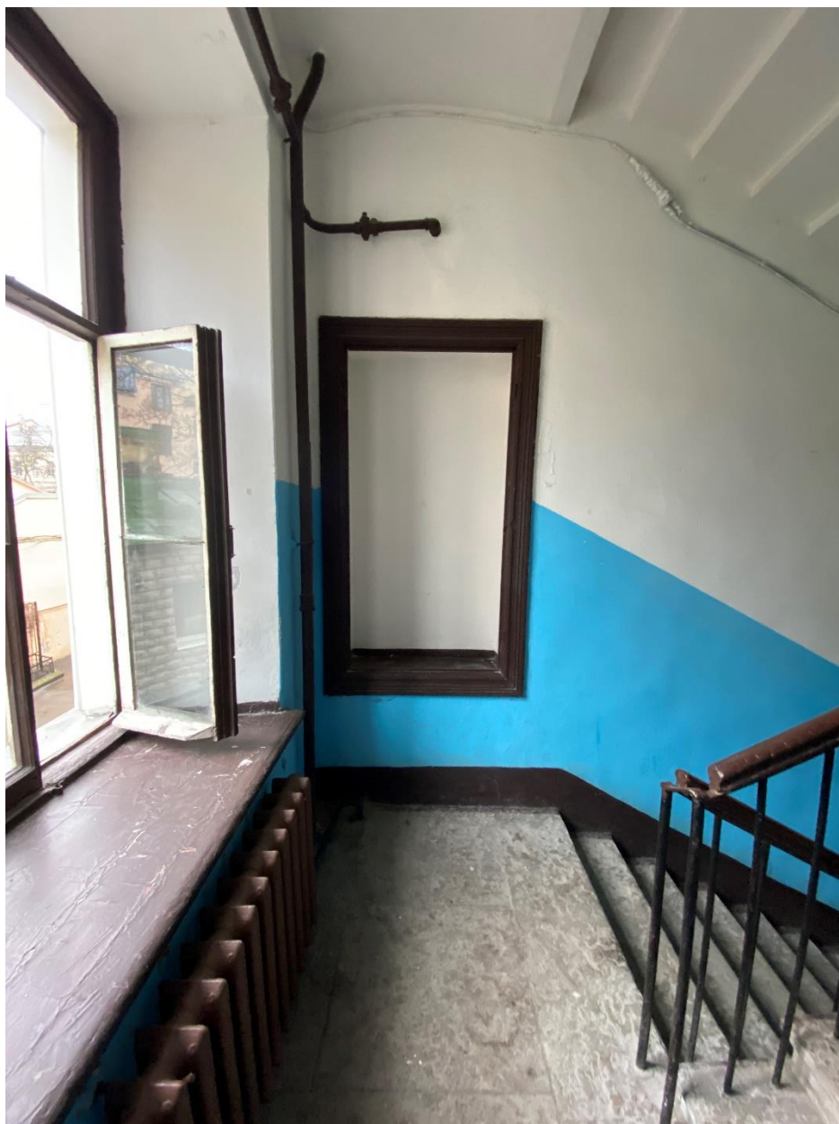
78. Лестница ЗЛК в уровне второго этажа
