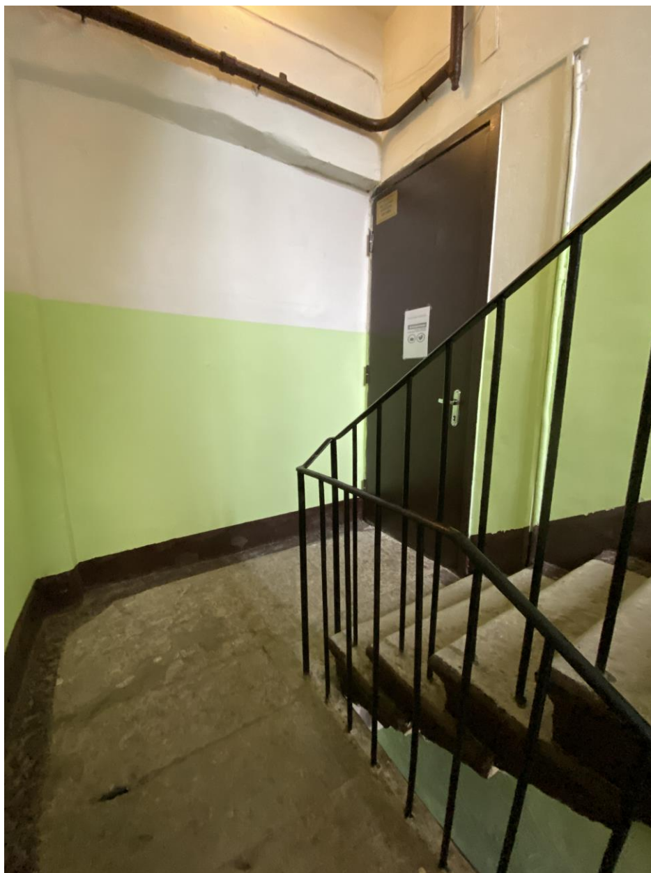
57. Лестница 2 ЛК в уровне первого этажа
