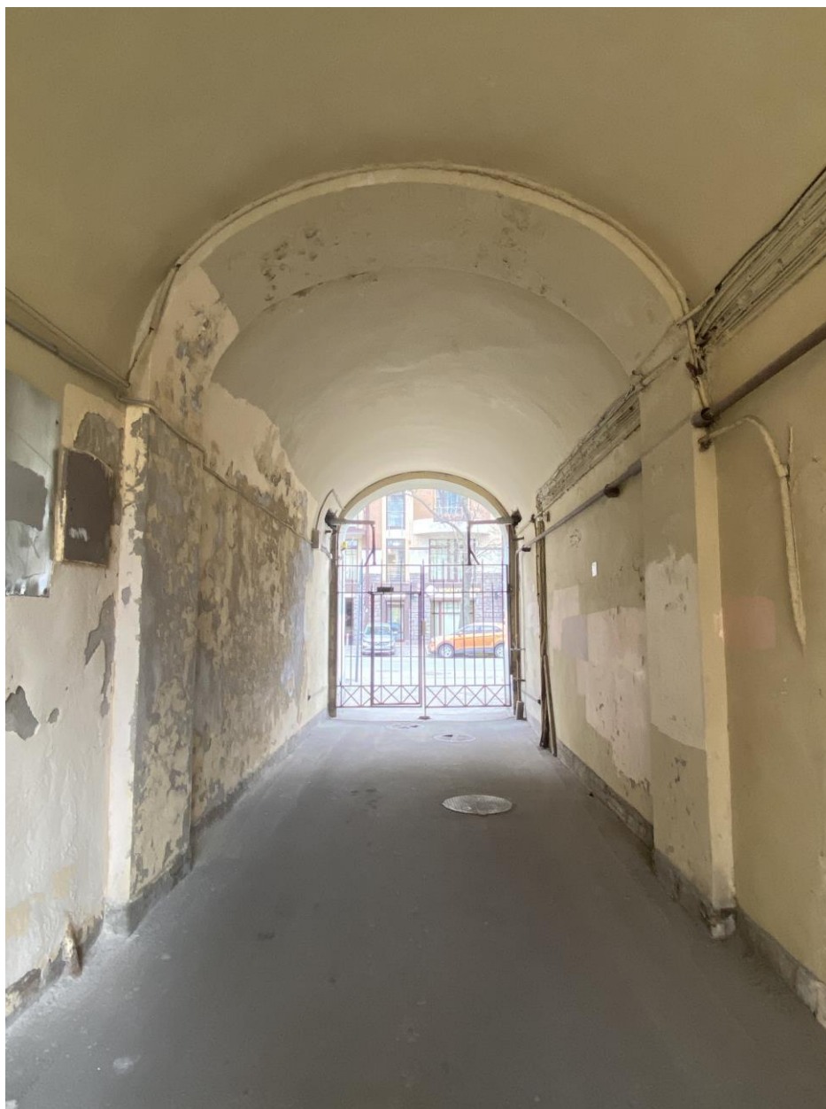
28. Воротный проезд, вид со стороны двора
