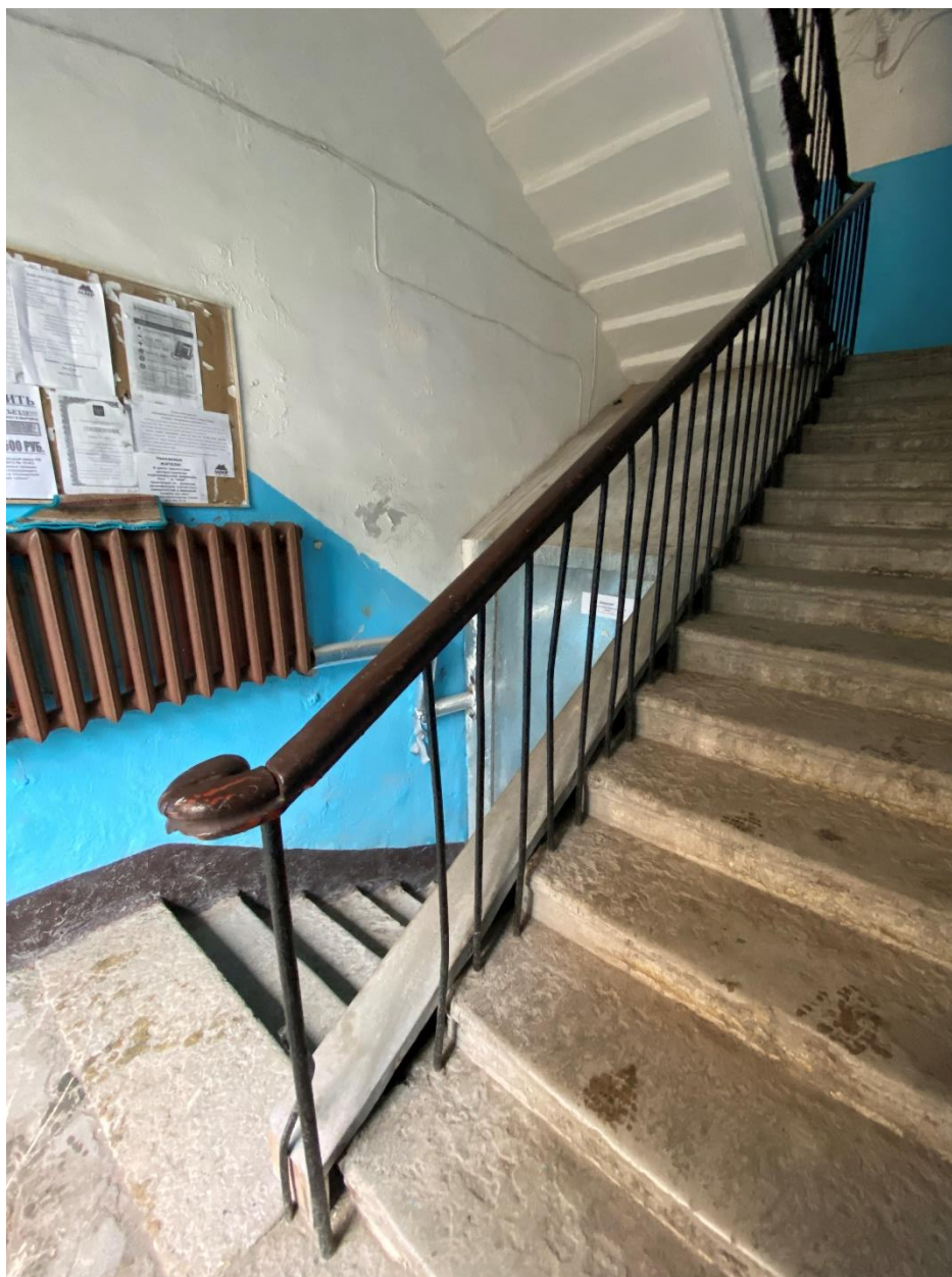
74. Лестница ЗЛК в уровне первого этажа
