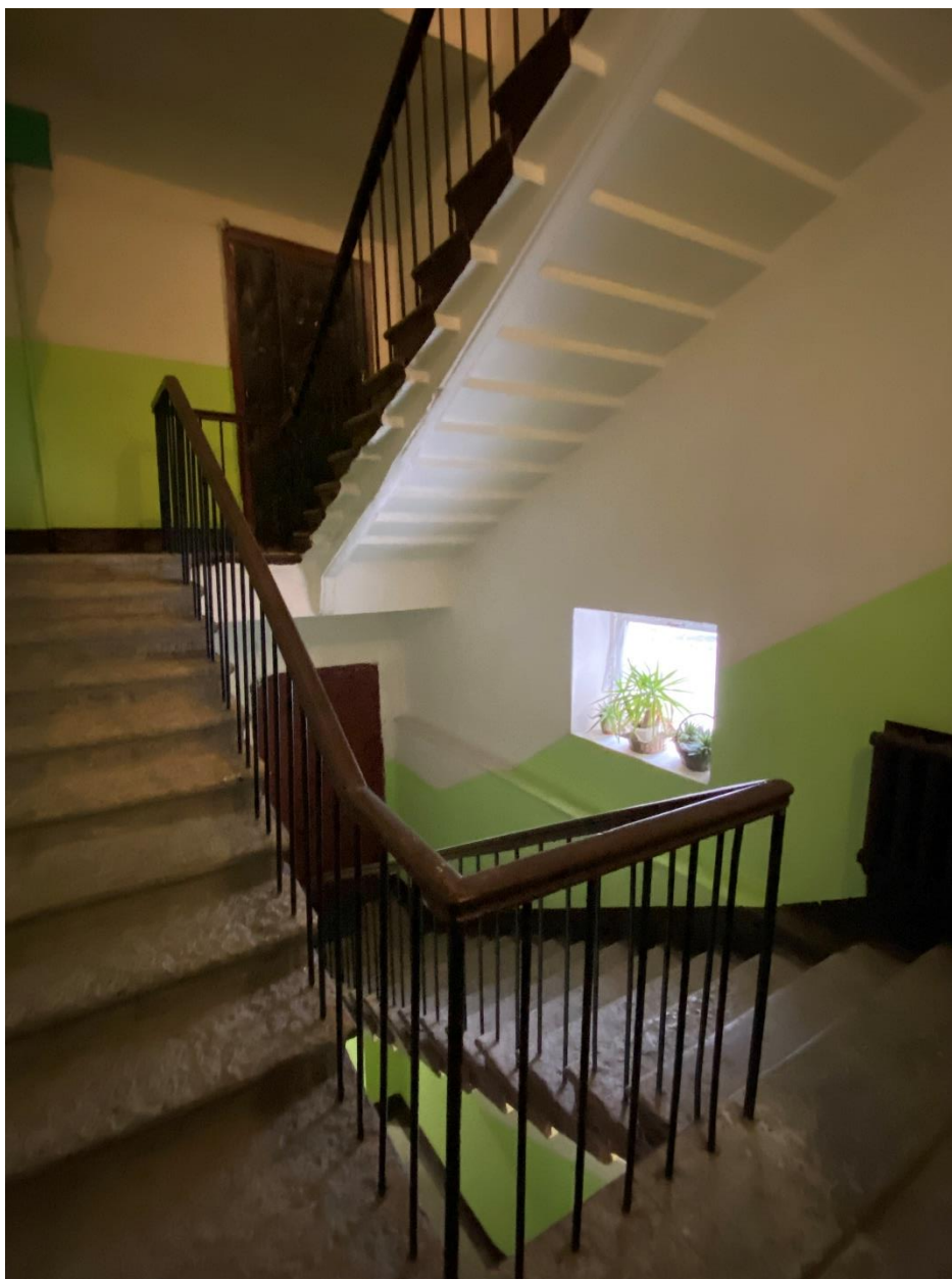
104. Лестница 4ЛК в уровне второго этажа
