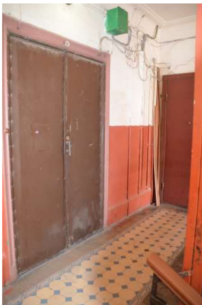
Фото 63. Выявленный объект культурного наследия «Дом П. М. Станового», расположенный по адресу Санкт-Петербург, 8-я Советская улица, д. 48, литера А. Вид лестницы. Съемка 26.04.2021.Егорова Т. Г.
