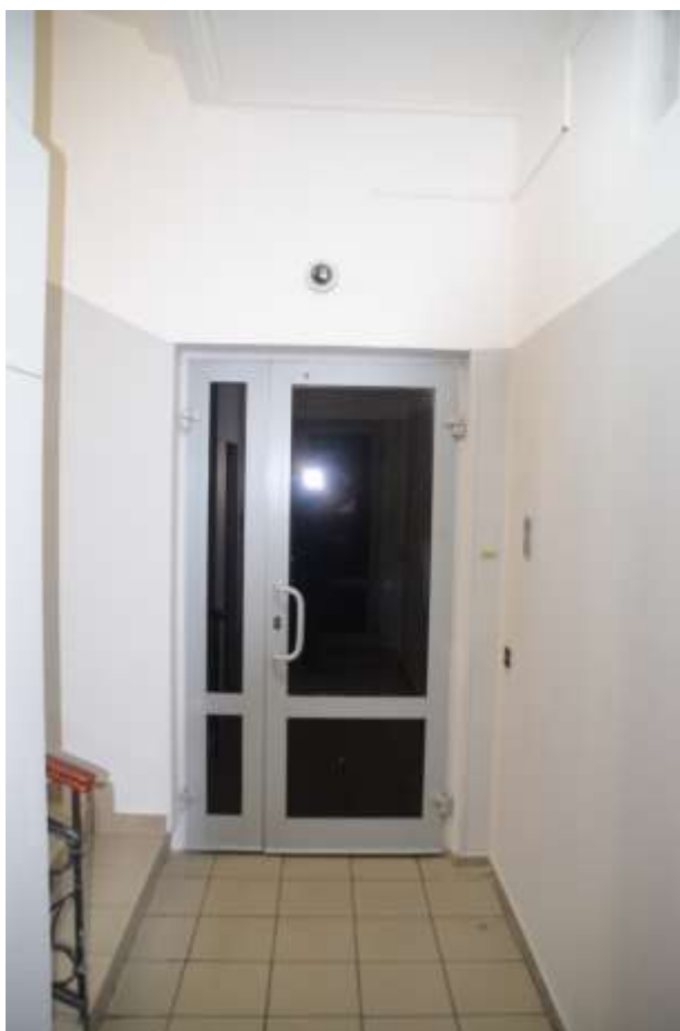
Фото 32. Выявленный объект культурного наследия «Дом П. М. Станового», расположенный по адресу Санкт-Петербург, 8-я Советская улица, д. 48, литера А. Вид площадки 4-го этажа. Съемка 26.04.2021. Егорова Т. Г.
