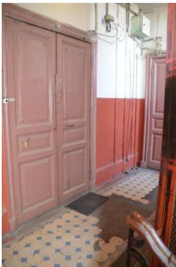
Фото 61. Выявленный объект культурного наследия «Дом П. М. Станового», расположенный по адресу Санкт-Петербург, 8-я Советская улица, д. 48, литера А. Вид лестницы. Съемка 26.04.2021.Егорова Т. Г.
