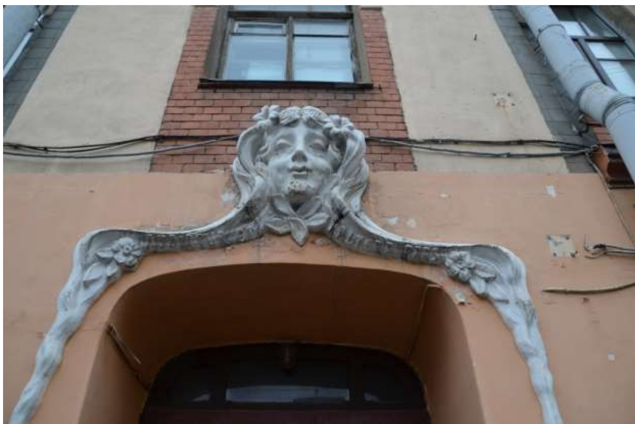
Фото 05. Выявленный объект культурного наследия «П. М. Станового», расположенный по адресу Санкт-Петербург, 8-я Советская улица, д. 48, литера А. Элемент декора южного фасада (женский маскарон над порталом). Съемка 26.04.2021. Егорова Т. Г.
