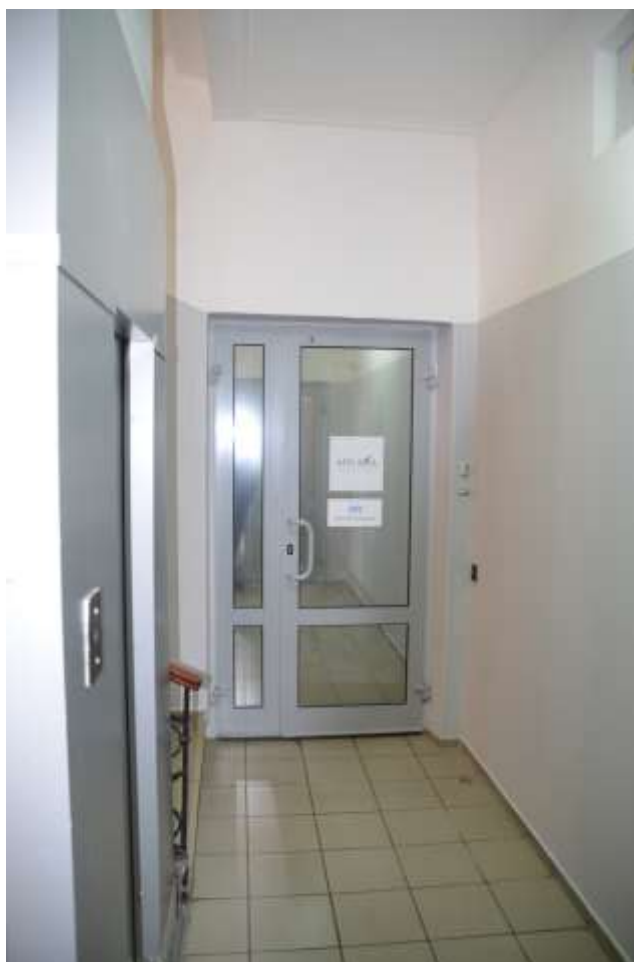
Фото 26. Выявленный объект культурного наследия «Дом П. М. Станового», расположенный по адресу Санкт-Петербург, 8-я Советская улица, д. 48, литера А. Вид площадки 3-го этажа. Съемка 26.04.2021. Егорова Т. Г.
