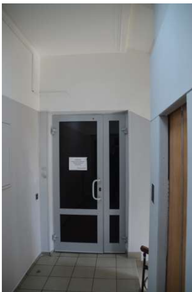
Фото 33. Выявленный объект культурного наследия «Дом П. М. Станового», расположенный по адресу Санкт-Петербург, 8-я Советская улица, д. 48, литера А. Вид площадки 4-го этажа. Съемка 26.04.2021. Егорова Т. Г.
