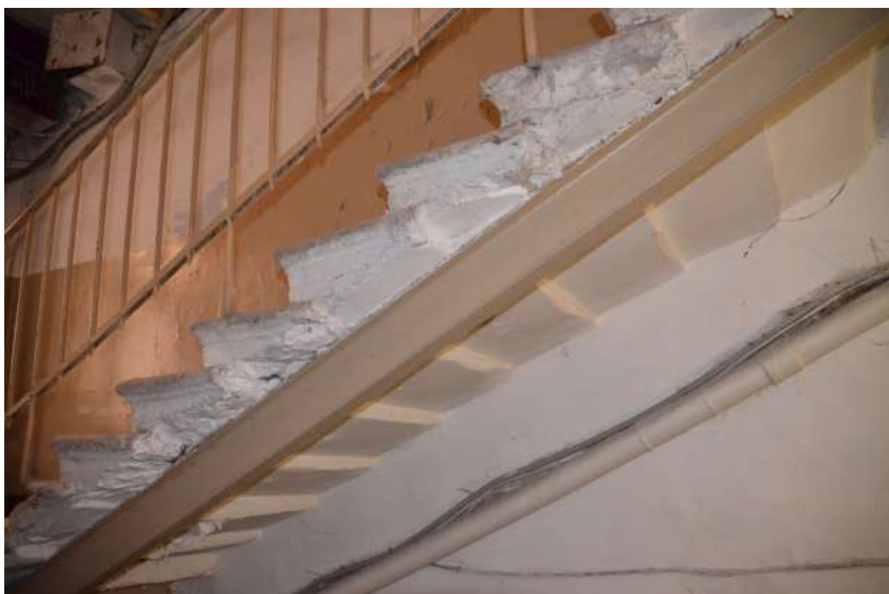
Фото 68. Выявленный объект культурного наследия «Дом П. М. Станового», расположенный по адресу Санкт-Петербург, 8-я Советская улица, д. 48, литера А. Вид конструкции черной лестницы. Съемка 26.04.2021.Егорова Т. Г.
