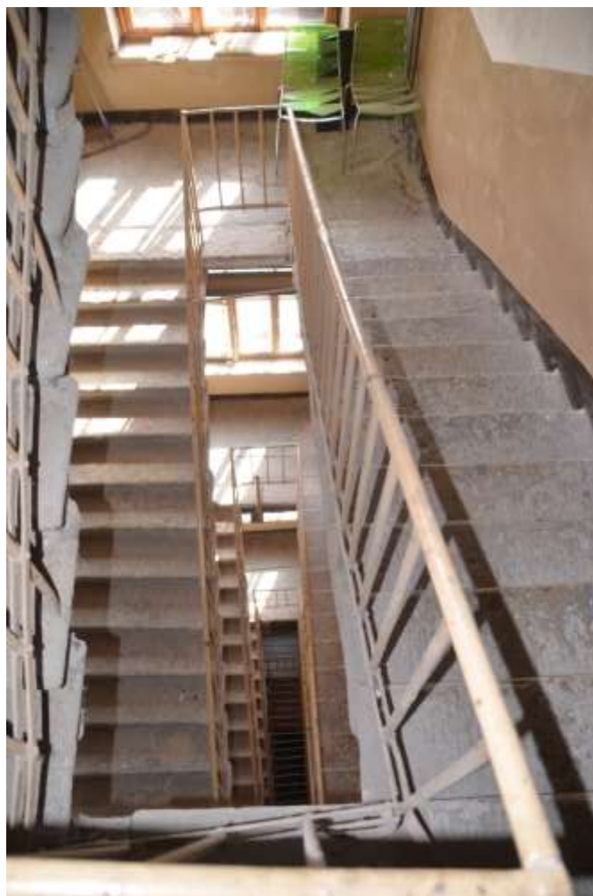
Фото 65. Выявленный объект культурного наследия «Дом П. М. Станового», расположенный по адресу Санкт-Петербург, 8-я Советская улица, д. 48, литера А. Общий вид черной лестницы. Съемка 26.04.2021.Егорова Т. Г.
