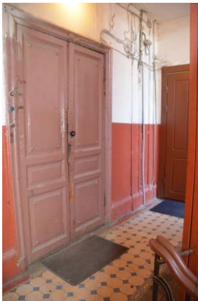
Фото 59. Выявленный объект культурного наследия «Дом П. М. Станового», расположенный по адресу Санкт-Петербург, 8-я Советская улица, д. 48, литера А. Вид лестницы. Съемка 26.04.2021.Егорова Т. Г.
