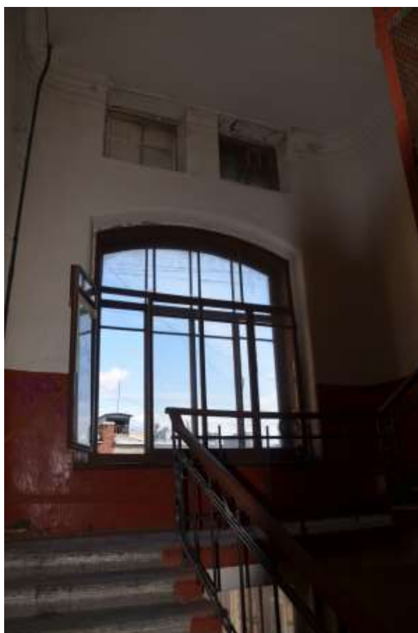
Фото 62. Выявленный объект культурного наследия «Дом П. М. Станового», расположенный по адресу Санкт-Петербург, 8-я Советская улица, д. 48, литера А. Вид лестницы. Съемка 26.04.2021.Егорова Т. Г.
