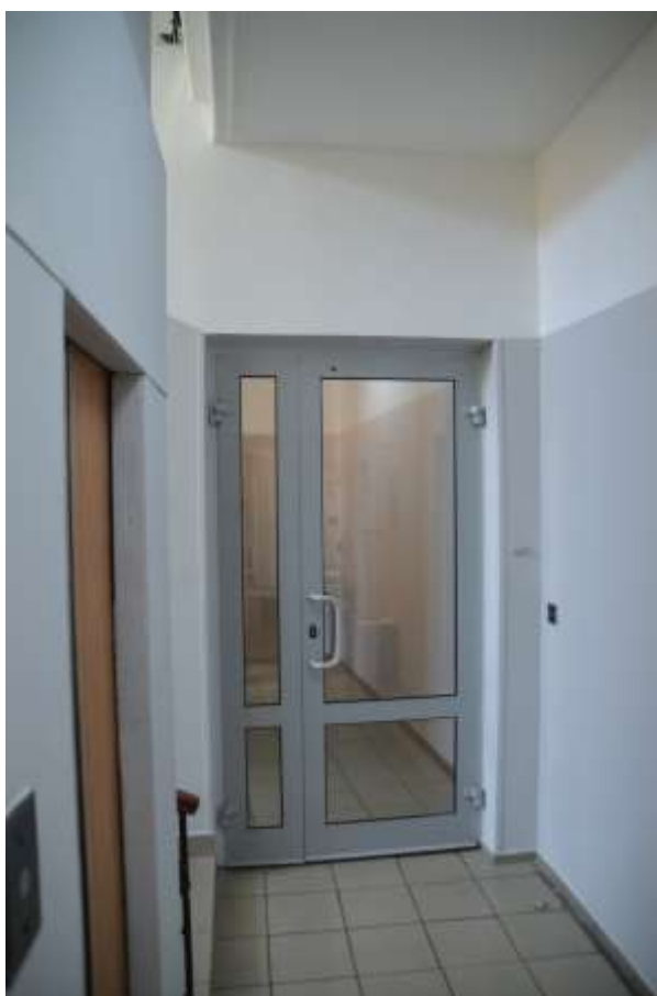
Фото 38. Выявленный объект культурного наследия «Дом П. М. Станового», расположенный по адресу Санкт-Петербург, 8-я Советская улица, д. 48, литера А. Вид площадки 5-го этажа. Съемка 26.04.2021. Егорова Т. Г.
