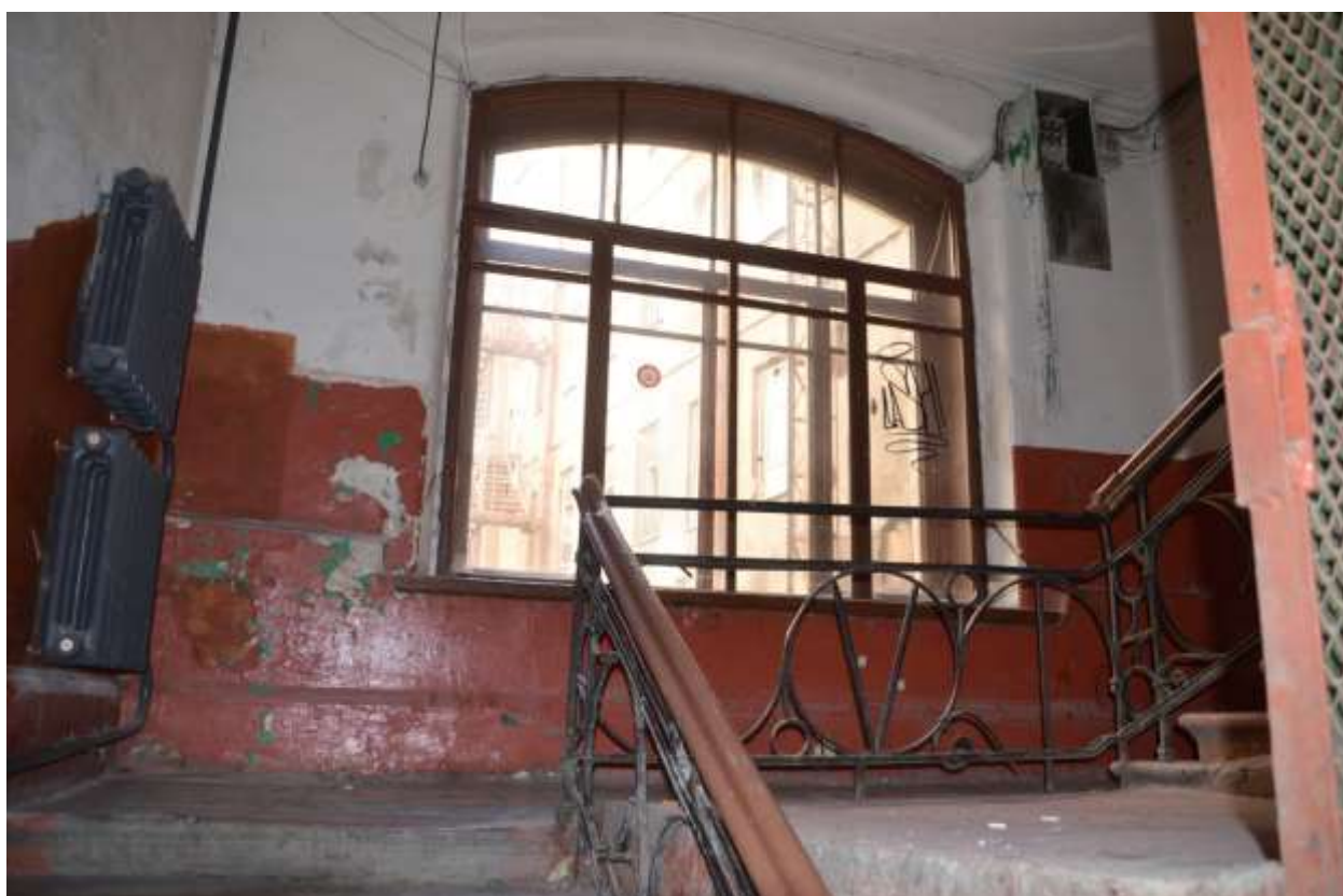
Фото 54. Выявленный объект культурного наследия «Дом П. М. Станового», расположенный по адресу Санкт-Петербург, 8-я Советская улица, д. 48, литера А. Вид лестницы. Съемка 26.04.2021.Егорова Т. Г.
