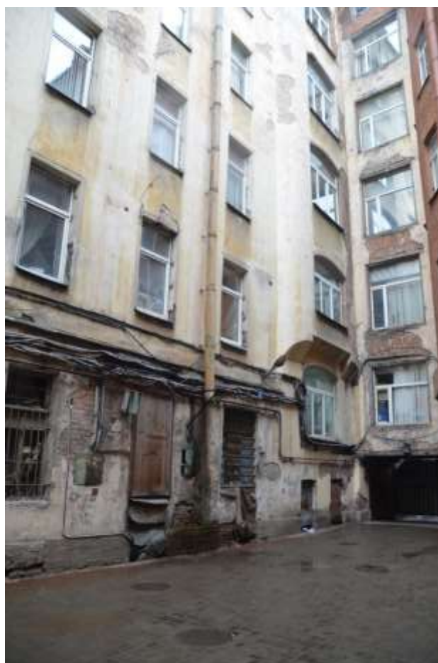
Фото 11. Выявленный объект культурного наследия «Дом П. М. Станового», расположенный по адресу Санкт-Петербург, 8-я Советская улица, д. 48, литера А. Вид восточного фасада. Фрагмент. Съемка 26.04.2021. Егорова Т. Г.
