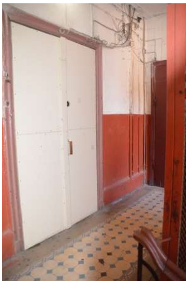
Фото 57. Выявленный объект культурного наследия «Дом П. М. Станового», расположенный по адресу Санкт-Петербург, 8-я Советская улица, д. 48, литера А. Вид лестницы. Съемка 26.04.2021.Егорова Т. Г.
