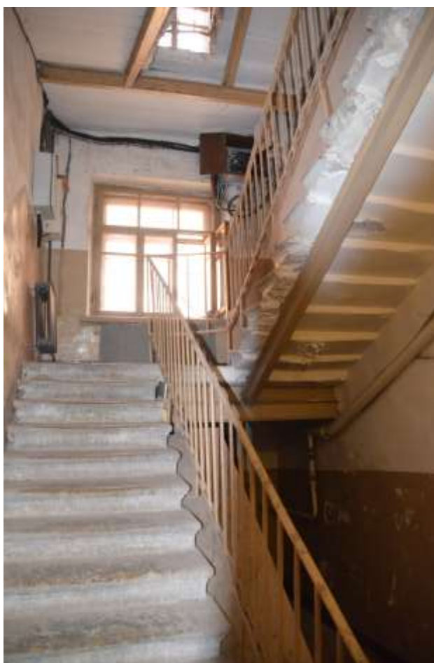
Фото 67. Выявленный объект культурного наследия «Дом П. М. Станового», расположенный по адресу Санкт-Петербург, 8-я Советская улица, д. 48, литера А. Вид черной лестницы. Съемка 26.04.2021.Егорова Т. Г.
