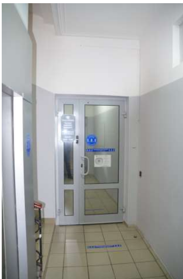
Фото 20. Выявленный объект культурного наследия «Дом П. М. Станового», расположенный по адресу Санкт-Петербург, 8-я Советская улица, д. 48, литера А. Вид площадки 2-го этажа лестницы по Мытнинской ул. Съемка 26.04.2021.Егорова Т. Г.
