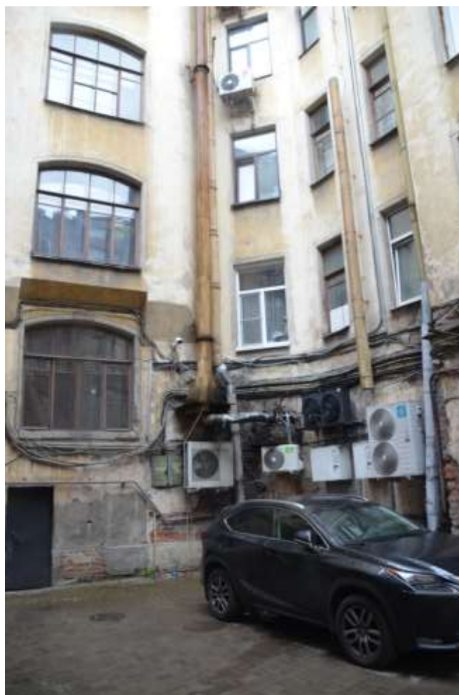
Фото 13. Выявленный объект культурного наследия «Дом П. М. Станового», расположенный по адресу Санкт-Петербург, 8-я Советская улица, д. 48, литера А. Вид северного и восточного фасада. Фрагмент. Съемка 26.04.2021. Егорова Т. Г.
