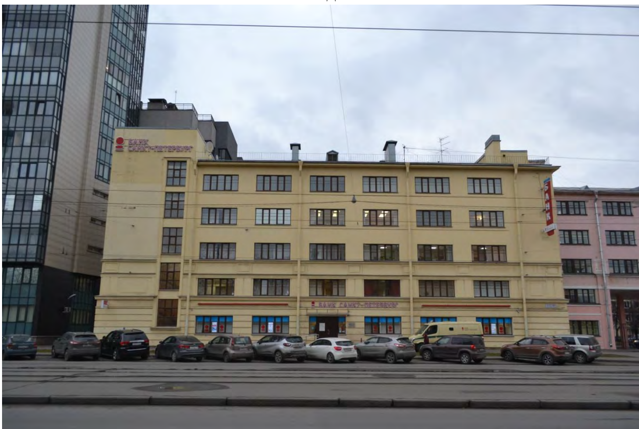
Фото 22. Лицевой фасад Общежития №1 («Жилой корпус») со стороны Лесного пр. Секция №3. Вид с юго-запада.
