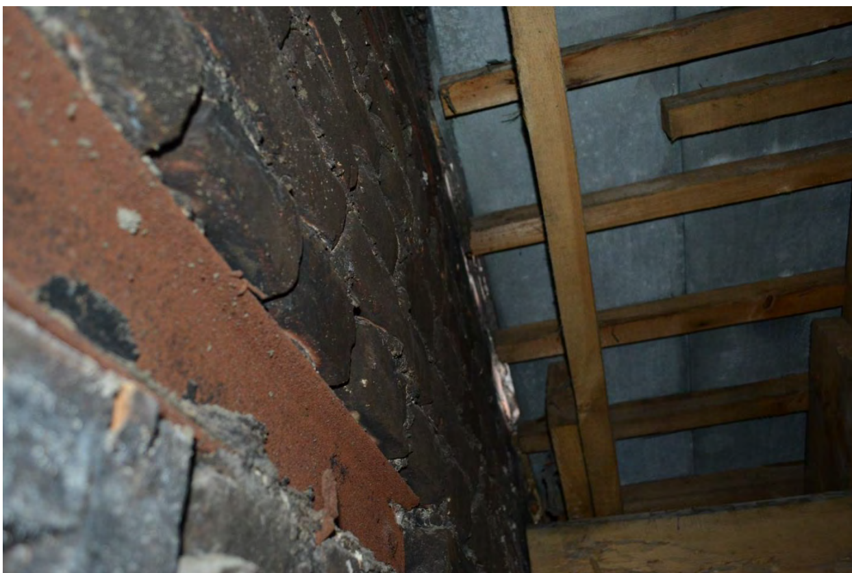
Фото 38. Чердачное пространство Общежития №1. Секция №2. Вид на узел примыкания кровли к брандмауэрной стене.
