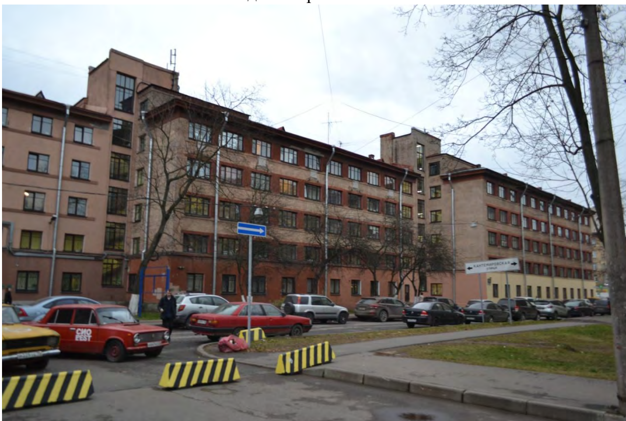
Фото 12. Вид на дворовую территорию Студенческого городка («Комплекс зданий Студенческого городка Политехнического института»). Парголовская ул. Вид с северо-запада.
