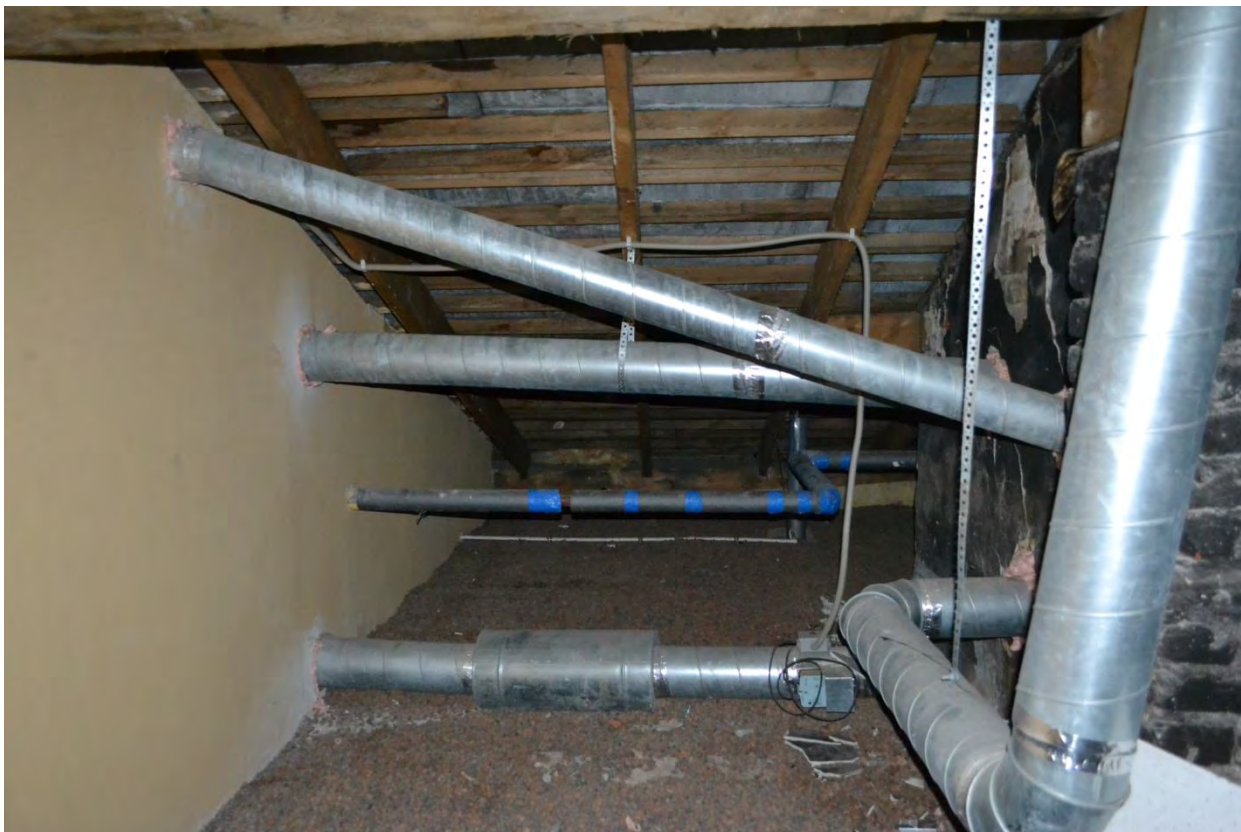
Фото 35. Чердачное пространство Общежития №1. Секция №2. Общий вид.
