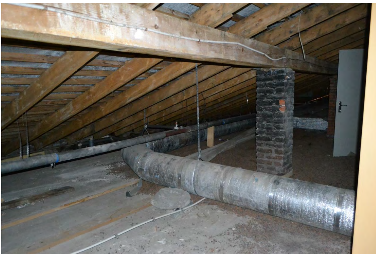
Фото 34. Чердачное пространство Общежития №1. Секция №2. Вид на стропильную систему.
