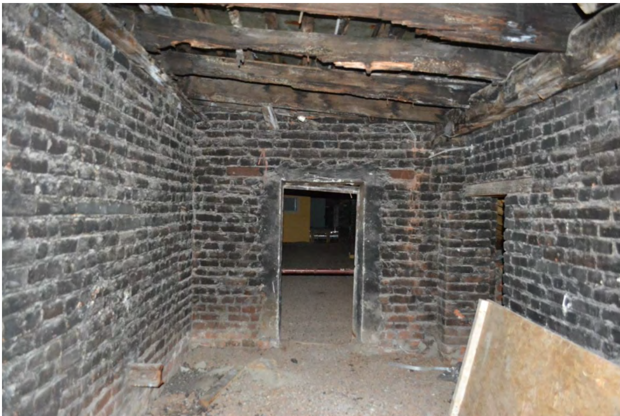
Фото 39. Чердачное пространство Общежития №1. Секция №2. Общий вид.
