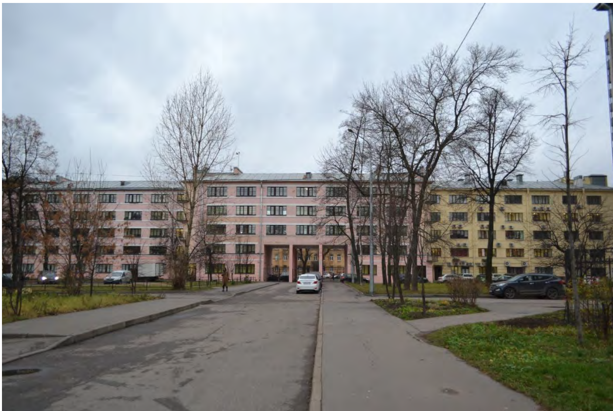
Фото 27. Общий вид на дворовой фасад Общежития №1. Вид с северо-востока.
