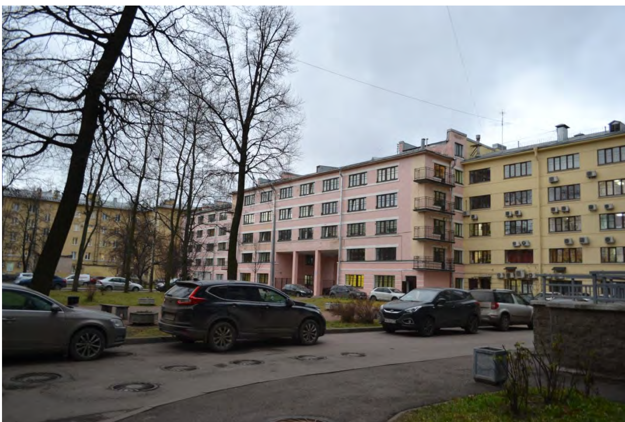
Фото 28. Общий вид на дворовой фасад Общежития №1. Вид с северо-востока.
