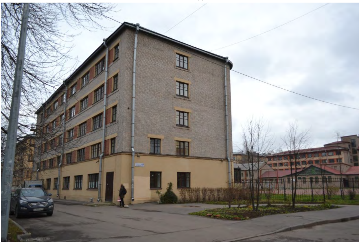
Фото 8. Вид на дворовую территорию Студенческого городка («Комплекс зданий Студенческого городка Политехнического института»). Жилой корпус. Вид с юго-запада.
