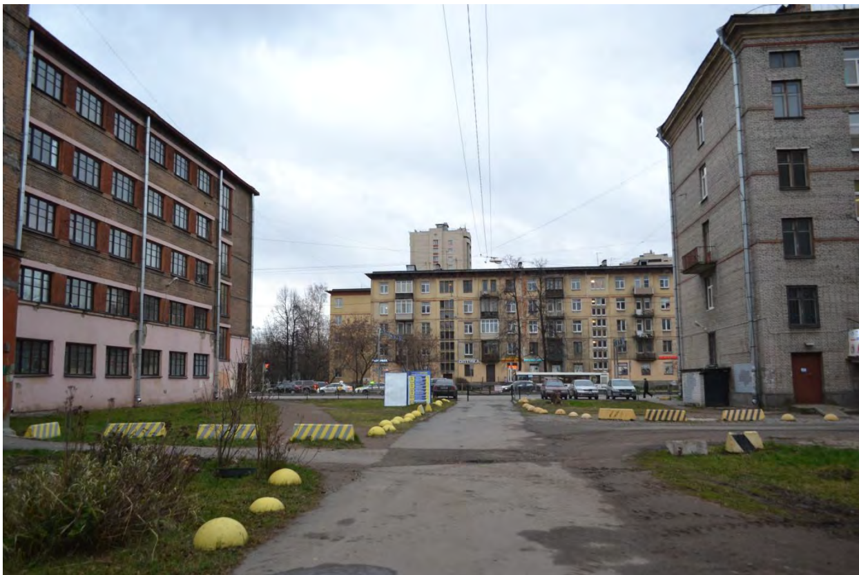
Фото 17. Вид на дворовую территорию Студенческого городка («Комплекс зданий Студенческого городка Политехнического института»). Вид с северо-запада.
