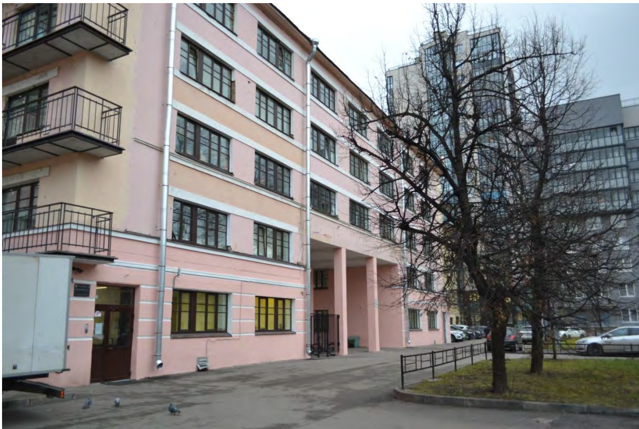
Фото 29. Общий вид на дворовой фасад Общежития №1. Секция №2. Вид с юго-востока.
