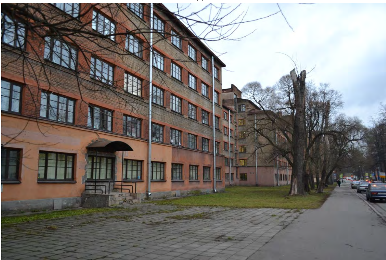
Фото 18. Вид на дворовую территорию Студенческого городка («Комплекс зданий Студенческого городка Политехнического института»). Жилой корпус по ул. Харченко. Вид с юго-востока.
