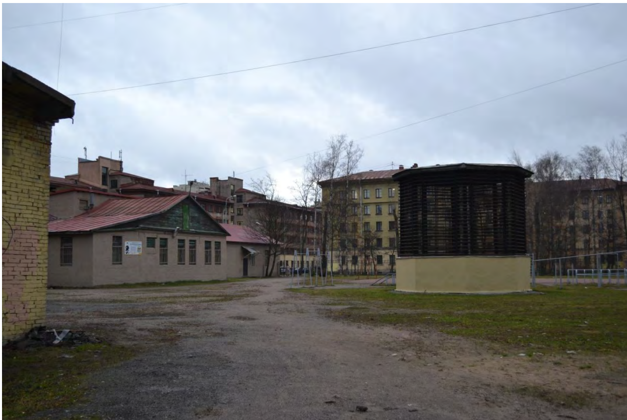
Фото 21. Вид на дворовую территорию Студенческого городка («Комплекс зданий Студенческого городка Политехнического института»). Вид с северо-запада.
