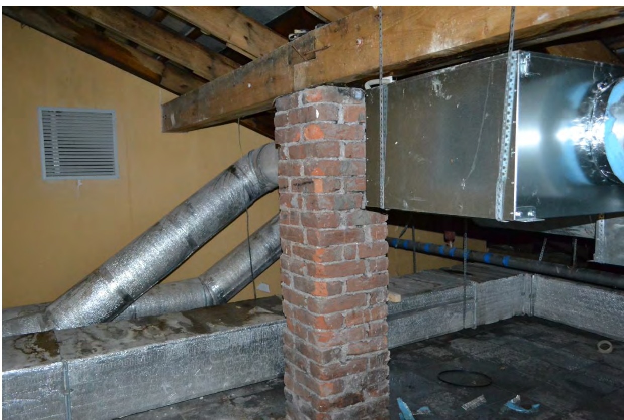
Фото 36. Чердачное пространство Общежития №1. Секция №2. Общий вид.
