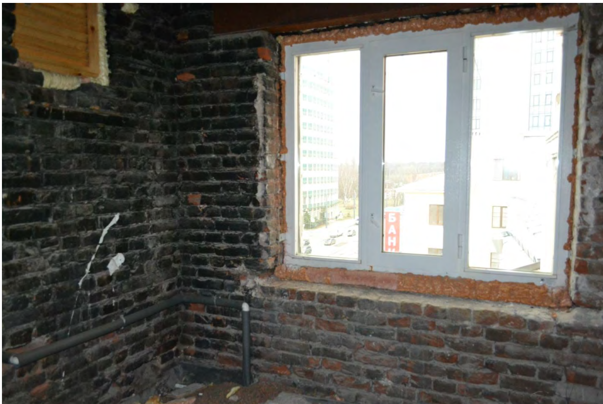
Фото 33. Чердачное пространство Общежития №1. Секция №2. Оконный проем.
