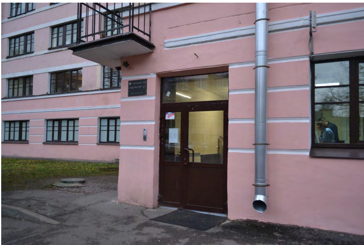
Фото 32. Один из исторических входов в здание со стороны дворового фасада Общежития №1. Секция №2. Вид с северо-востока.
