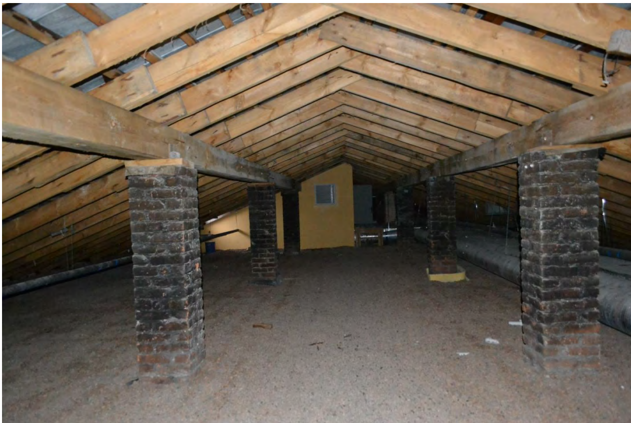
Фото 37. Чердачное пространство Общежития №1. Секция №2. Общий вид.
