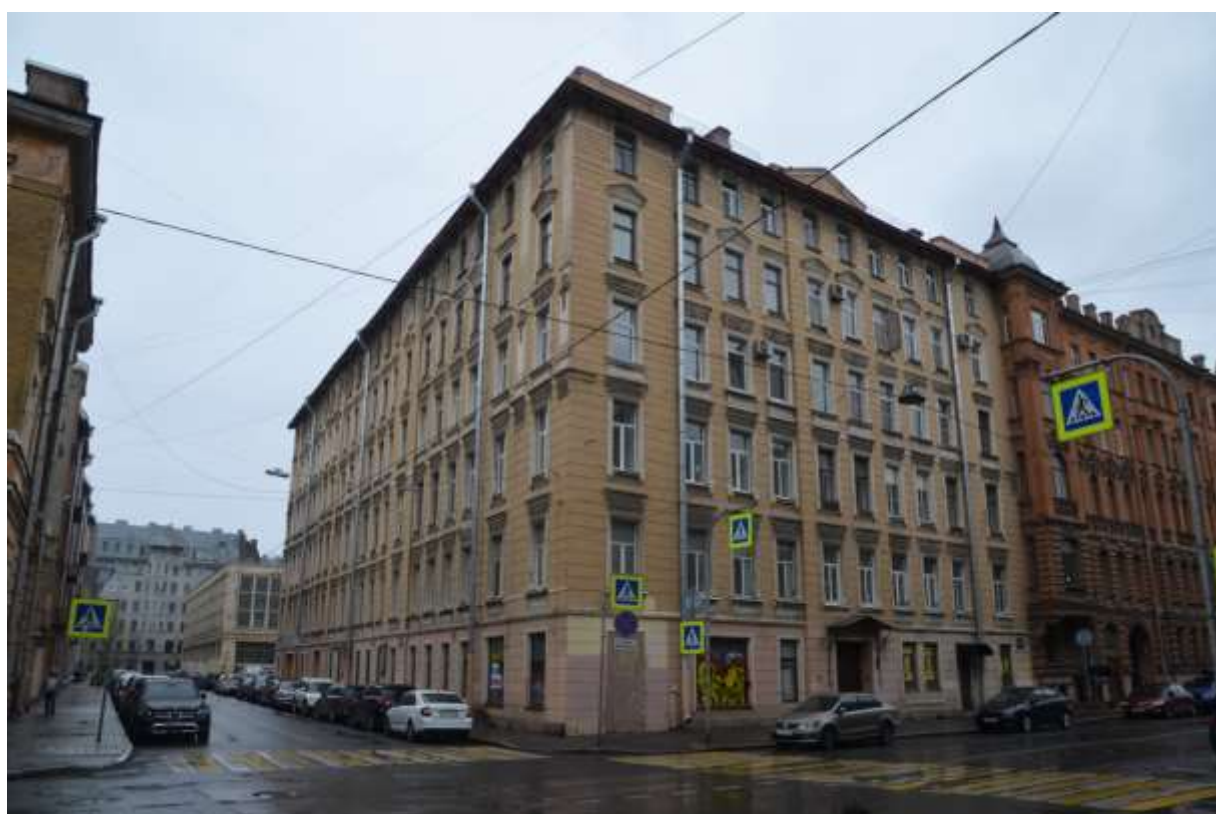
Фото 01. Выявленный объект культурного наследия «Дом И. С. Мальцева», расположенный по адресу Санкт-Петербург, Басков пер., 41/29, литера А (Басков пер., 41, ул. Радищева, 29). Общий вид западного и северного фасадов. Съемка 26.04.2021. Егорова Т. Г.
