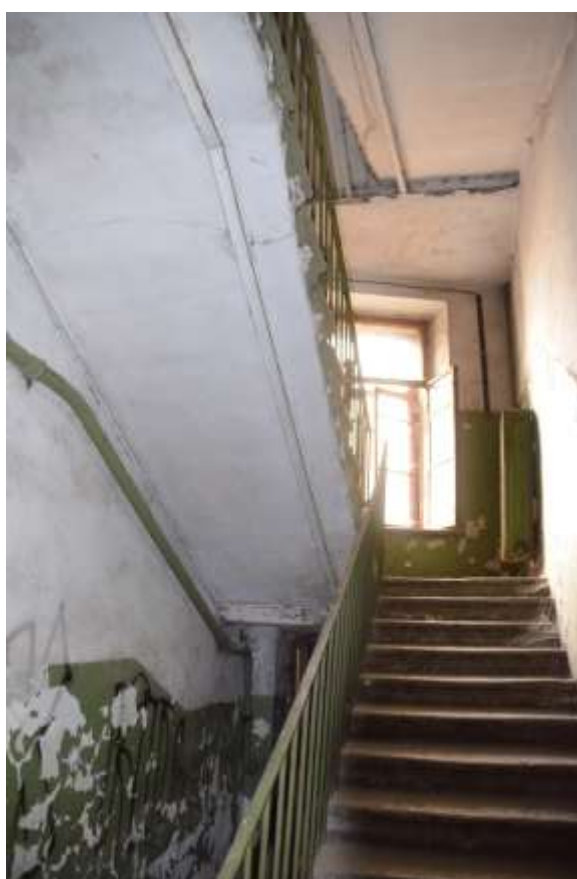
Фото 38. Выявленный объект культурного наследия «Дом И. С. Мальцева», расположенный по адресу Санкт-Петербург, Басков пер., 41/29, литера А (Басков пер., 41, ул. Радищева, 29). Вид черной лестницы. Съемка 26.04.2021. Егорова Т. Г.
