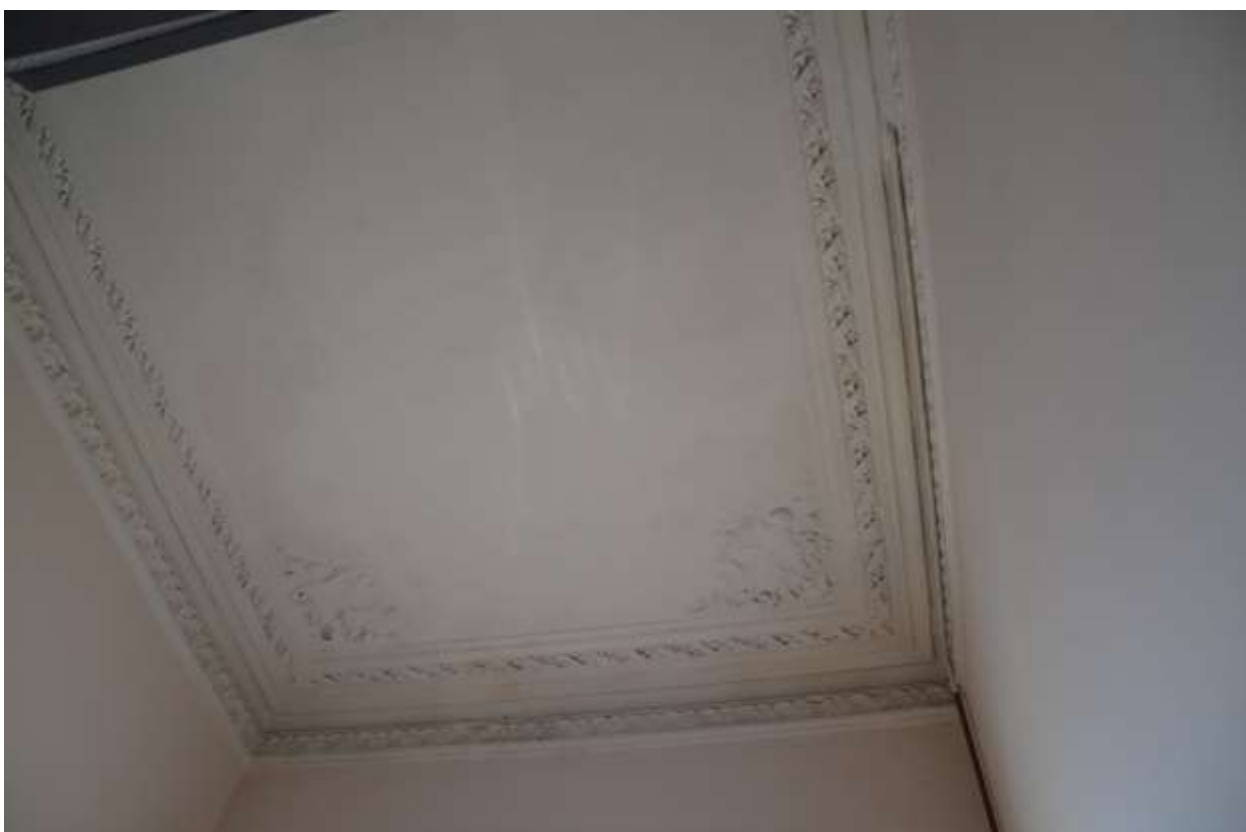
Фото 22. Выявленный объект культурного наследия «Дом И. С. Мальцева», расположенный по адресу Санкт-Петербург, Басков пер., 41/29, литера А (Басков пер., 41, ул. Радищева, 29). Вид потолка парадной лестницы по Баскову переулку. Фрагмент. Съемка 26.04.2021. Егорова Т. Г.
