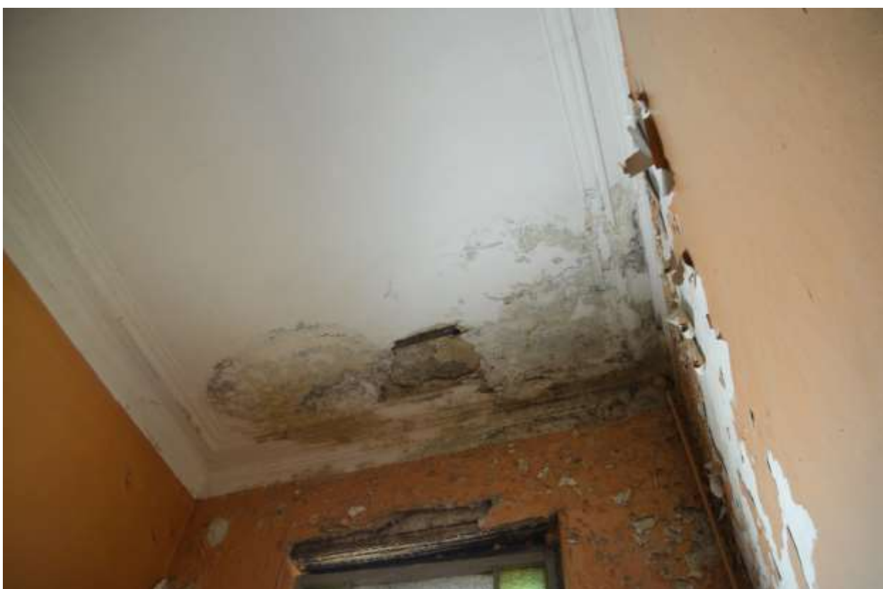
Фото 37. Выявленный объект культурного наследия «Дом И. С. Мальцева», расположенный по адресу Санкт-Петербург, Басков пер., 41/29, литера А (Басков пер., 41, ул. Радищева, 29). Вид потолка парадной лестницы по ул. Радищева. Фрагмент. Съемка 26.04.2021. Егорова Т. Г.
