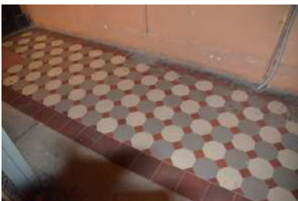
Фото 26. Выявленный объект культурного наследия «Дом И. С. Мальцева», расположенный по адресу Санкт-Петербург, Басков пер., 41/29, литера А (Басков пер., 41, ул. Радищева, 29). Напольное покрытие части вестибюля и лестничных площадок парадной лестницы по ул. Радищева. Съемка 26.04.2021. Егорова Т. Г.
