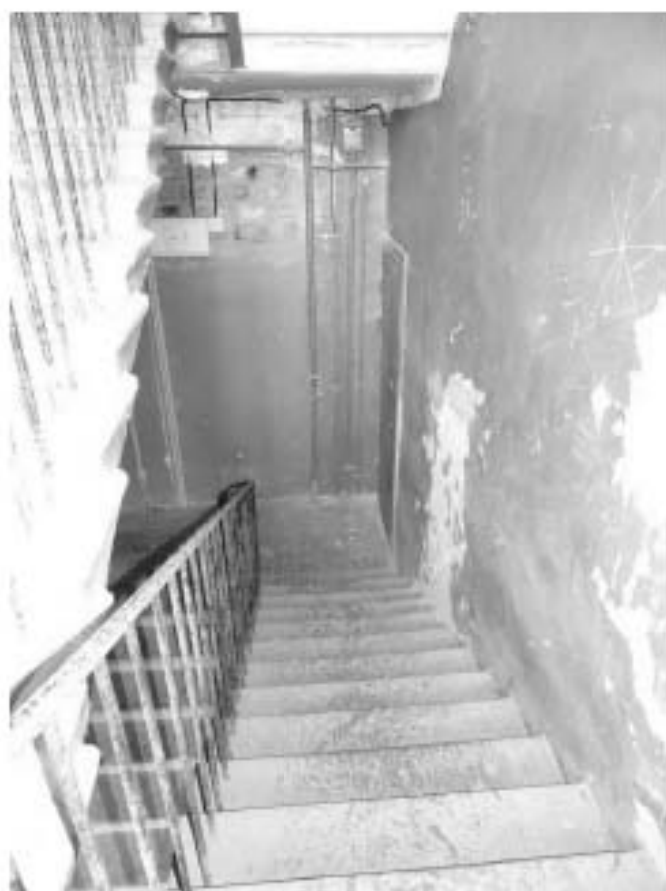
Фото 132. Лестница № 12: Площадка 4-го этажа. Съемка 19.04.2021 г. Михайловская Г. В.
