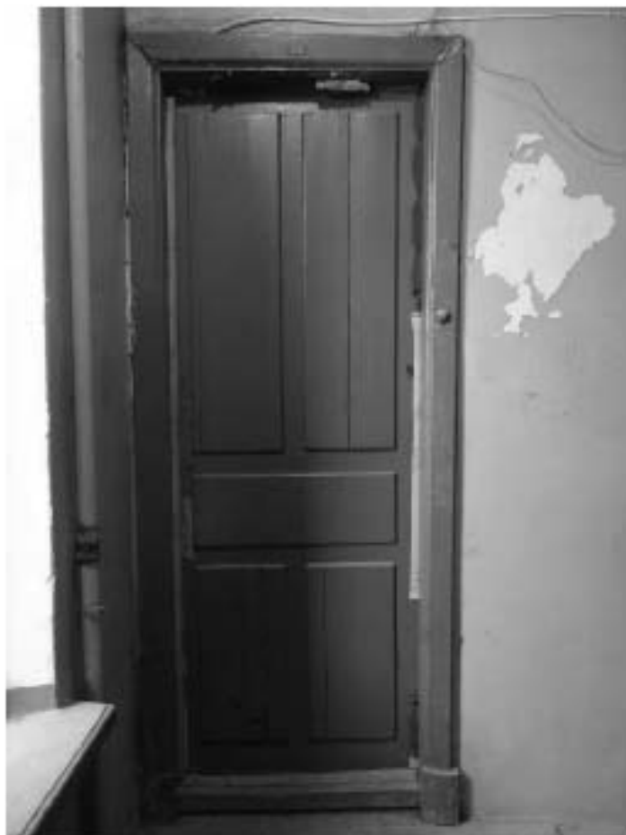
Фото 351. Лестница № 7: 6-й этаж. Съемка 19.04.2021 г. Михайловская Г. В.
