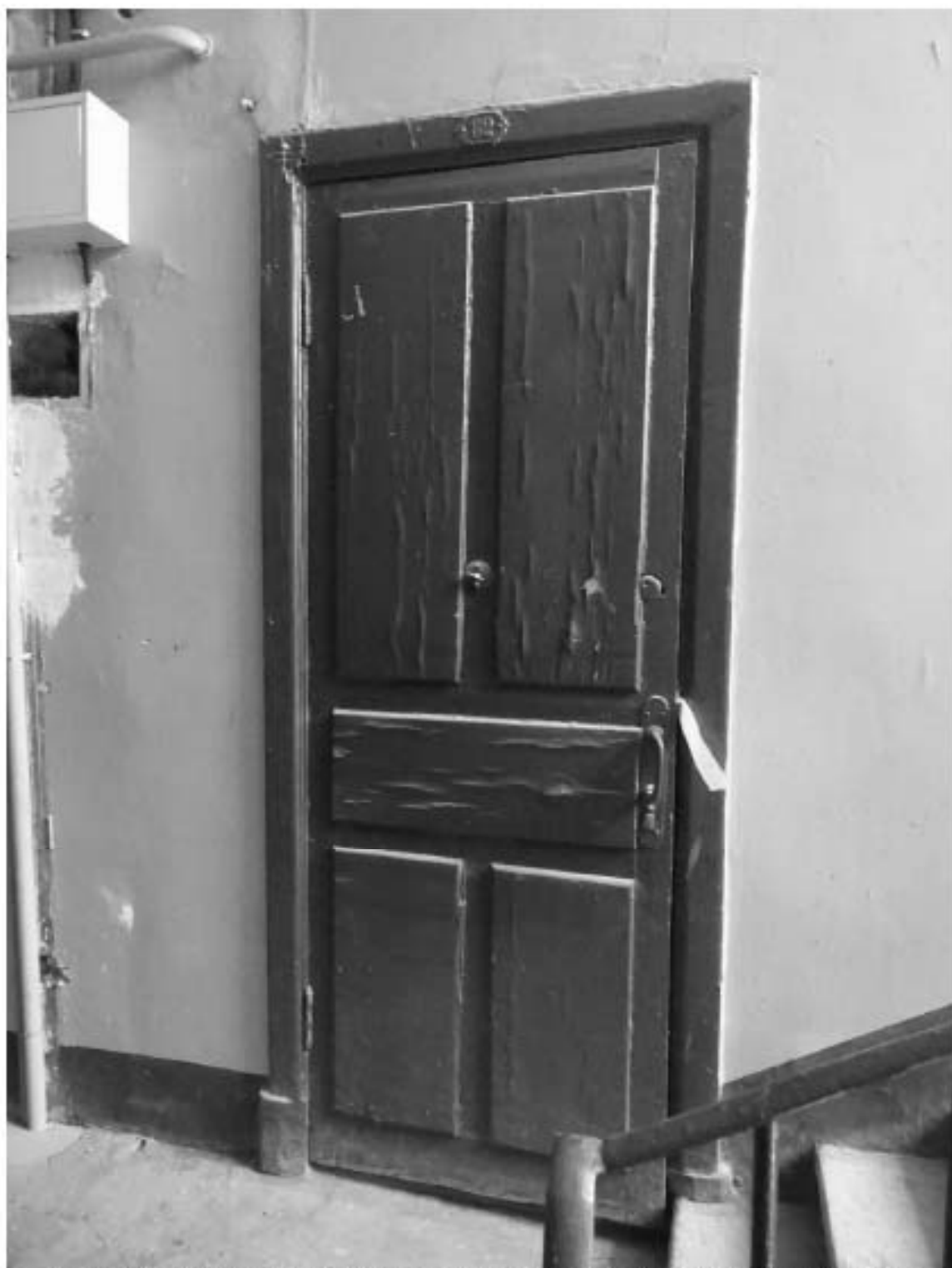
Фото 375. Лестница № 8: 5-й этаж. Съёмка 19.04.2021 г. Михайловская Г. В.
