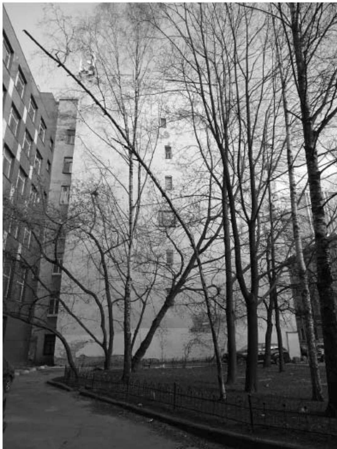
Фото 23. Здание по адресу: г. Санкт-Петербург, Большой проспект П.С., дом 74, литера А. Западный торцевой фасад. Съемка 19.04.2021 г. Михайловская Г. В.
