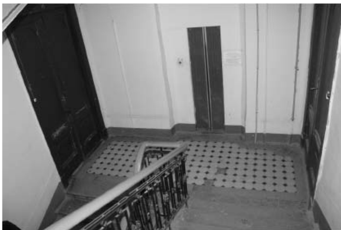
Фото 57. Лестница № 2: Площадка 5-го этажа. Съемка 19.04.2021 г. Михайловская Г. В.
