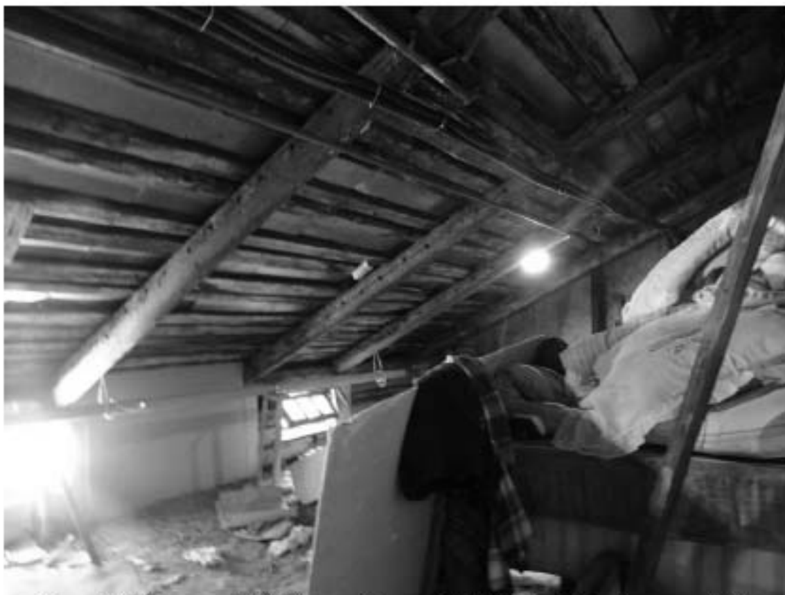
Фото 357. Лестница № 7: Чердак. Съёмка 19.04.2021 г. Михайловская Г. В.
