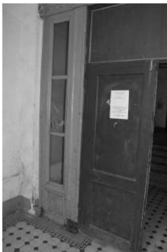
Фото 16. 1-й этаж. Вестибюль по Большому проспекту. Оформление двери. Съемка 19.04.2021 г. Михайловская Г. В.
