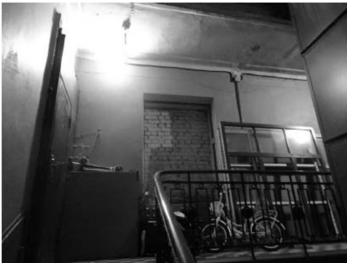
Фото 329. Лестница № 6: 6-й этаж. Съемка 19.04.2021 г. Михайловская Г. В.
