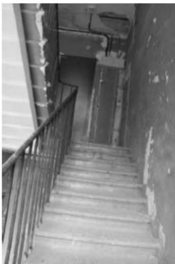
Фото 169. Лестница № 13: Площадка 7-го этажа. Съемка 19.04.2021 г. Михайловская Г. В.
