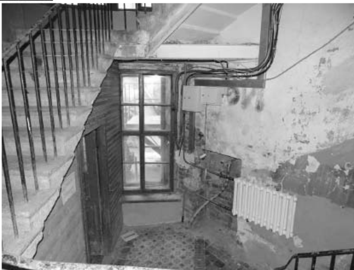
Фото 86. Лестница № 11: Вестибюль 1-го этажа. Тамбур. Съемка 19.04.2021 г. Михайловская Г. В.
