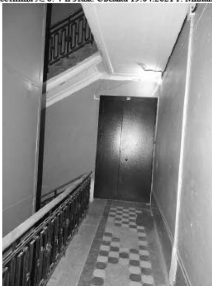
Фото 322. Лестница № 6: 4-й этаж. Съемка 19.04.2021 г. Михайловская Г. В.
