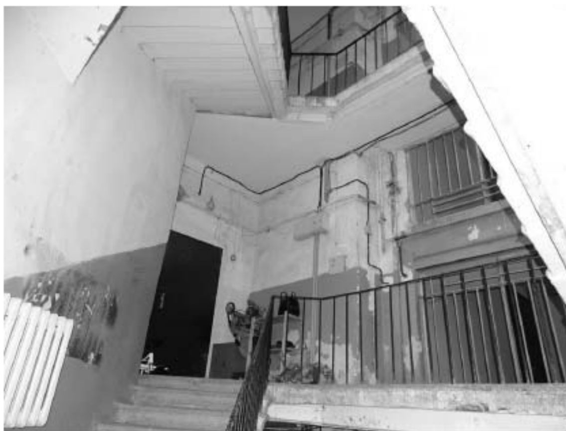
Фото 95. Лестница № 11: Площадка 3-го этажа. Съемка 19.04.2021 г. Михайловская Г. В.
