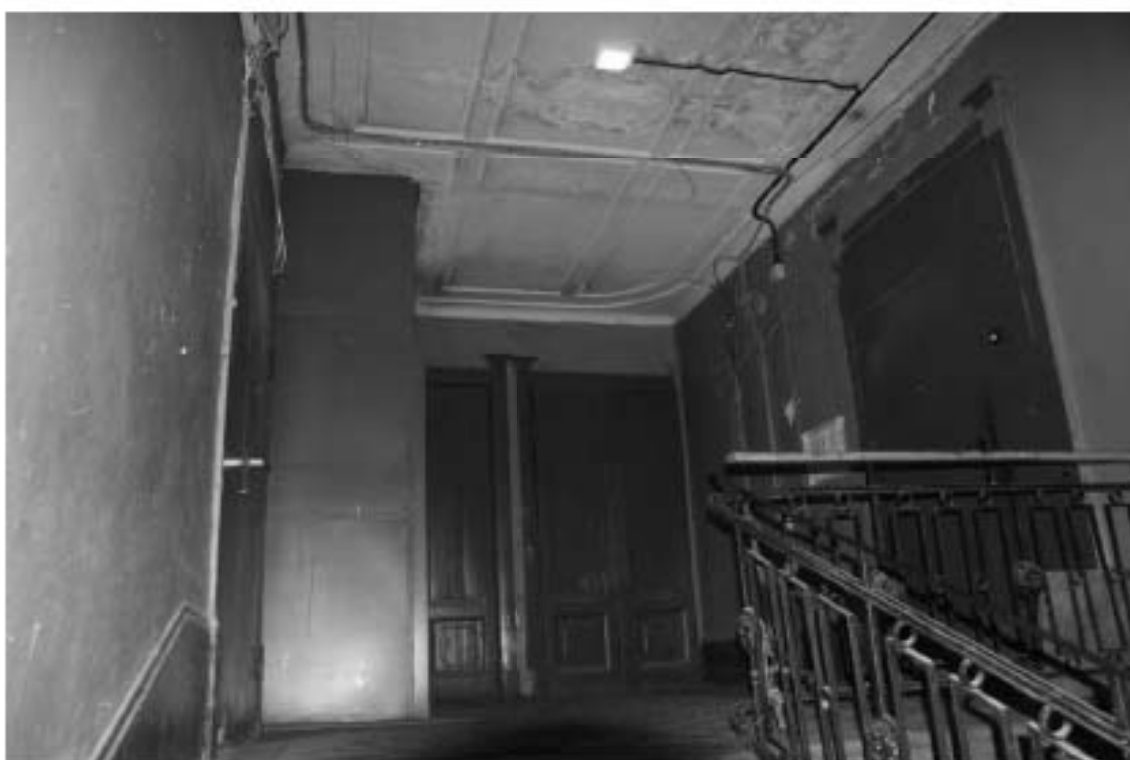
Фото 295. Лестница № 5: 7-й этаж. Съемка 19.04.2021 г. Михайловская Г. В.
