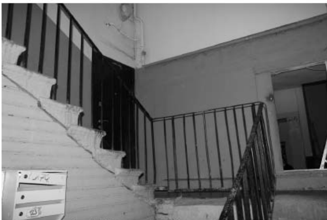
Фото 74. Лестница № 10: Площадка 2-го этажа. Съемка 19.04.2021 г. Михайловская Г. В.
