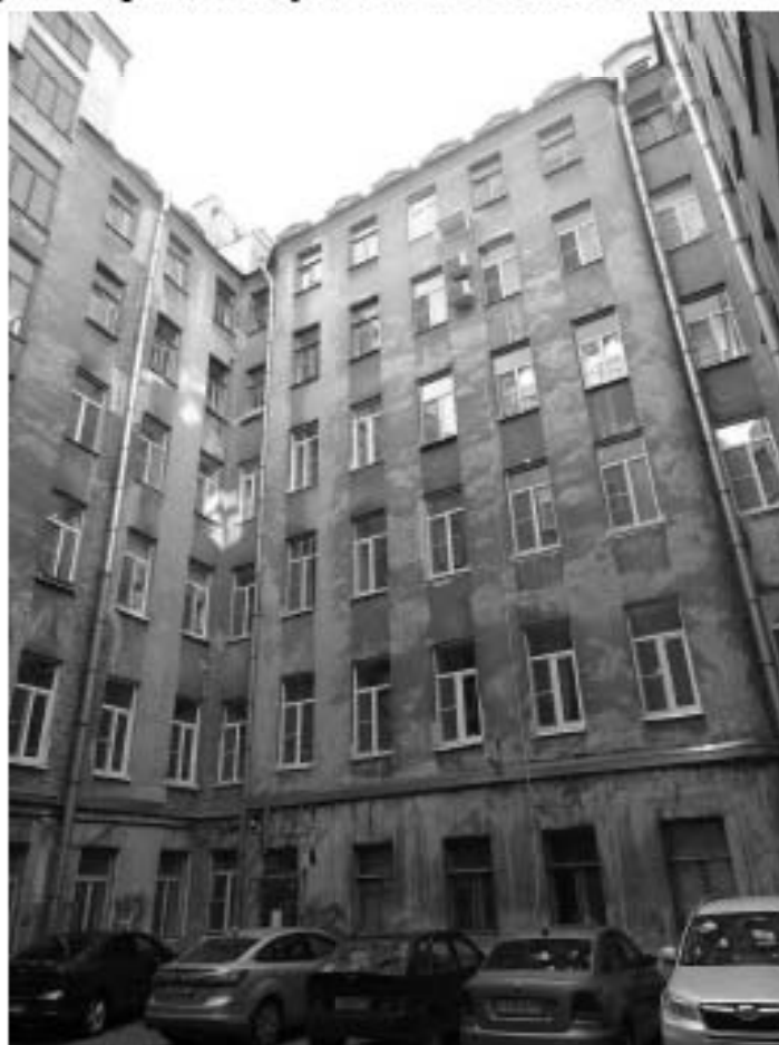
Фото 27. Здание по адресу: г. Санкт-Петербург, Большой проспект П.С., дом 74, литера А. Западный внутренний двор. Съемка 19.04.2021 г. Михайловская Г. В.
