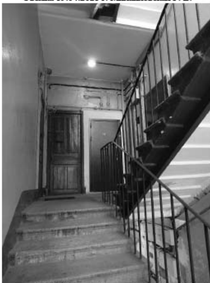
Фото 366. Лестница № 8: 2-й этаж. Съемка 19.04.2021 г. Михайловская Г. В.
