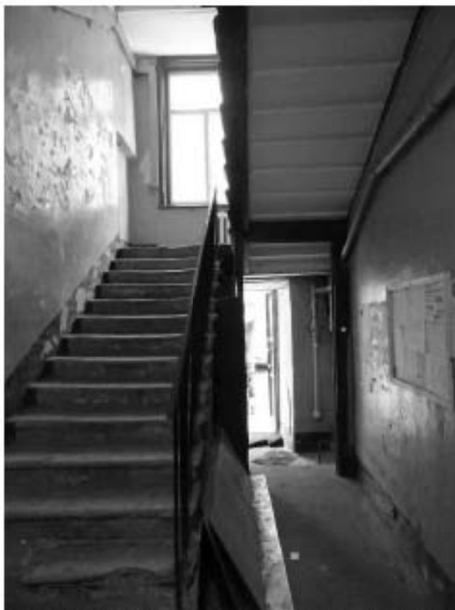
Фото 359. Лестница № 8: 1-й этаж. Съемка 19.04.2021 г. Михайловская Г. В.
