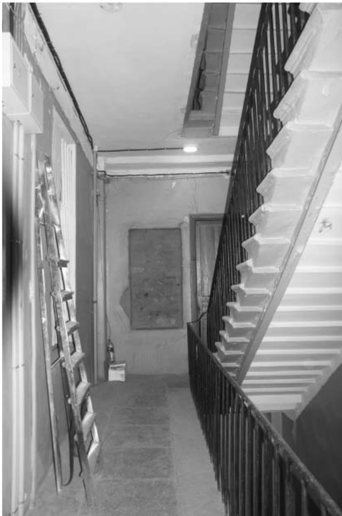
Фото 340. Лестница № 7: 2-й этаж. Съемка 19.04.2021 г. Михайловская Г. В.
