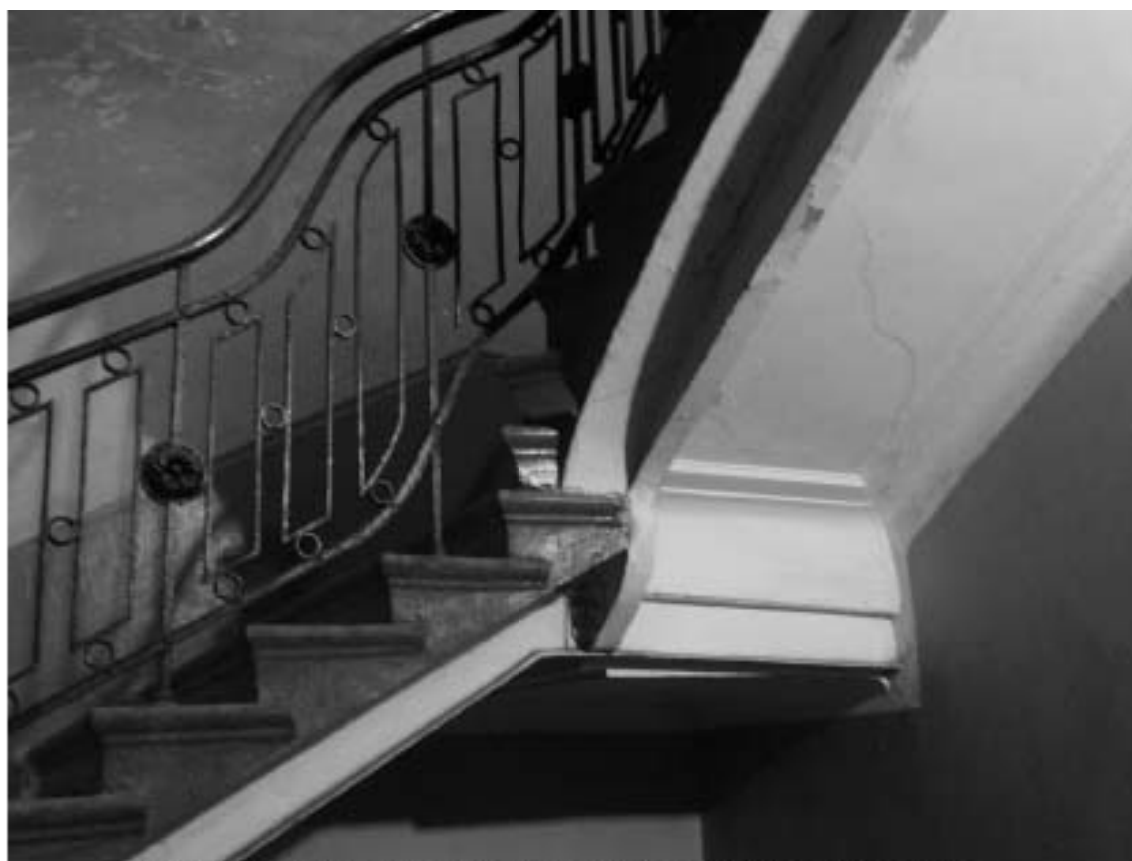
Фото 320. Лестница № 6: Площадка между 3-м и 4-м этажом. Съёмка 19.04.2021 г. Михайловская Г. В.
