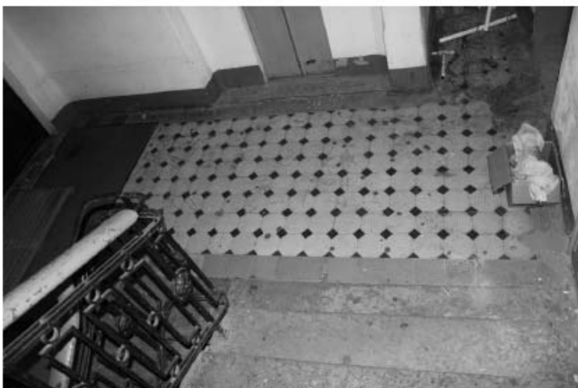
Фото 49. Лестница № 2: 2-й этаж. Покрытие пола. Съемка 19.04.2021 г. Михайловская Г. В.
