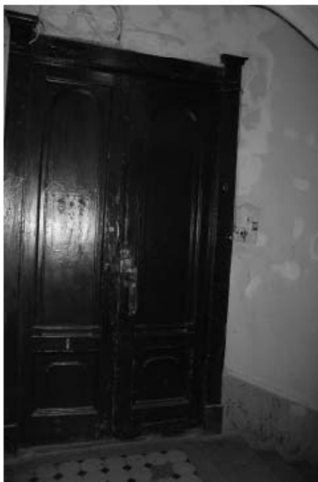
Фото 27. Лестница № 1: Площадка 4-го этажа. Оформление двери. Съемка 19.04.2021 г. Михайловская Г. В.
