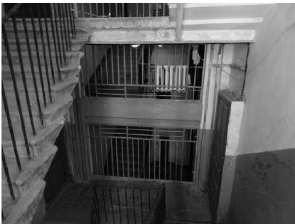
Фото 104. Лестница № 11: Площадка 5-го этажа. Съемка 19.04.2021 г. Михайловская Г. В.
