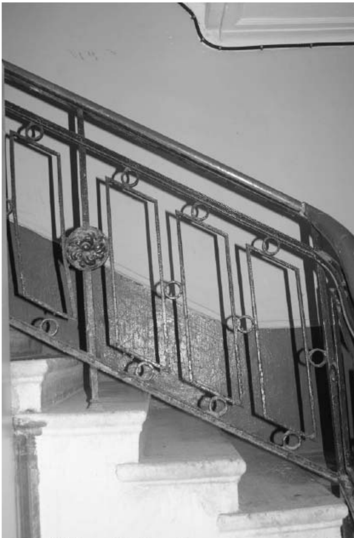
Фото 236. Лестница № 4: 1-й этаж. Фрагмент лестничного ограждения. Съемка 19.04.2021 г. Михайловская Г. В.
