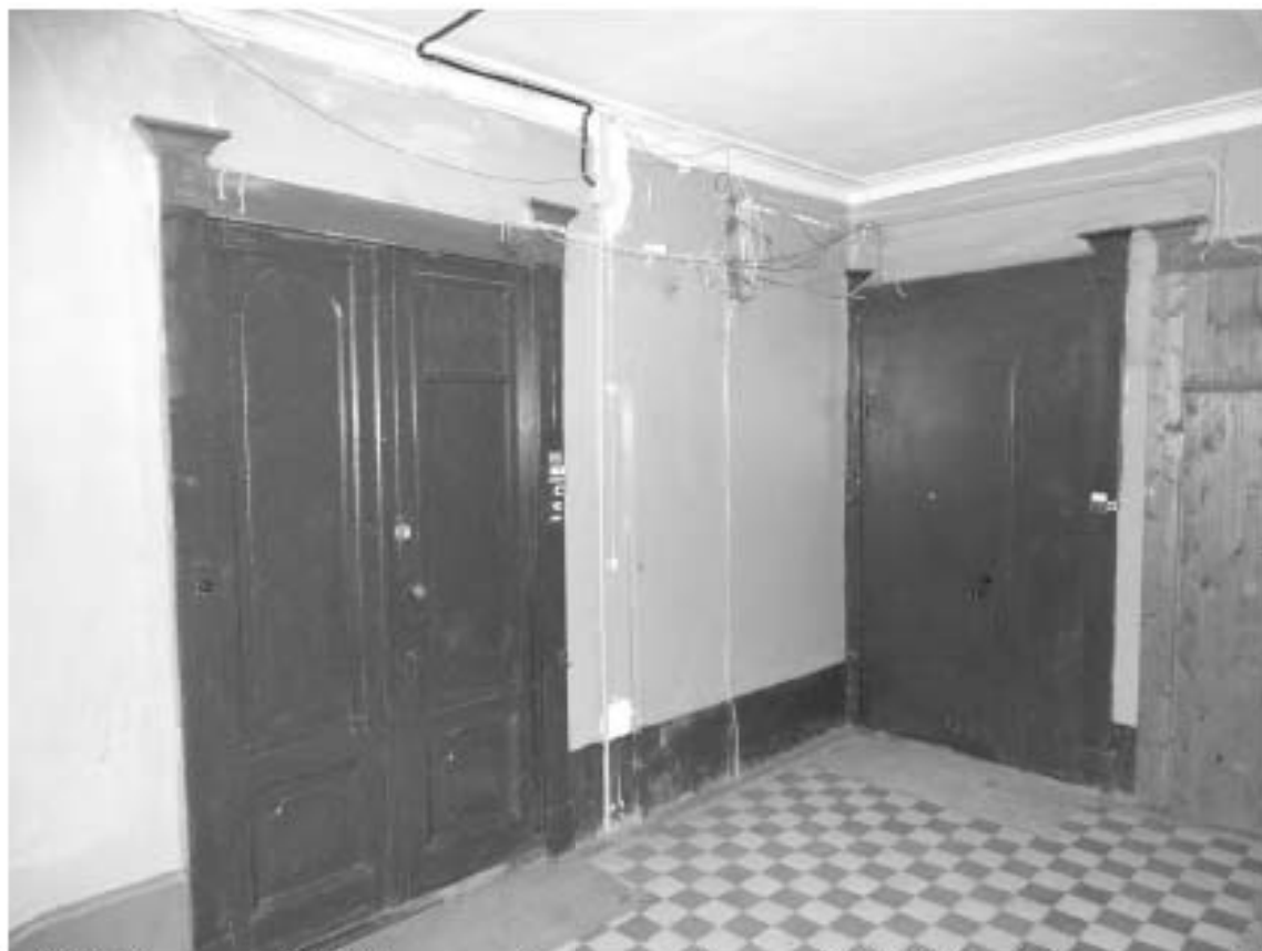
Фото 221. Лестница № 3: Площадка 6-го этажа. Съемка 19.04.2021 г. Михайловская Г. В.
