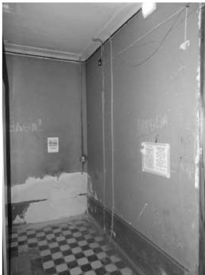
Фото 327. Лестница № 6: 5-й этаж. Съемка 19.04.2021 г. Михайловская Г. В.
