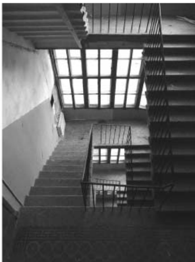
Фото 79. Лестница № 10: Лестничный марш. Вид на площадку между 4-м и 5-м этажом. Съемка 19.04.2021 г. Михайловская Г. В.
