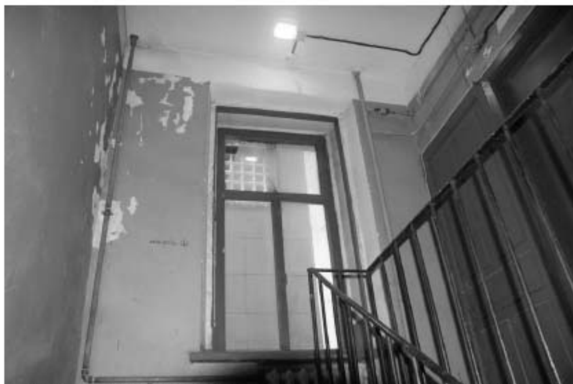
Фото 342. Лестница № 7: 3-й этаж. Съёмка 19.04.2021 г. Михайловская Г. В.
