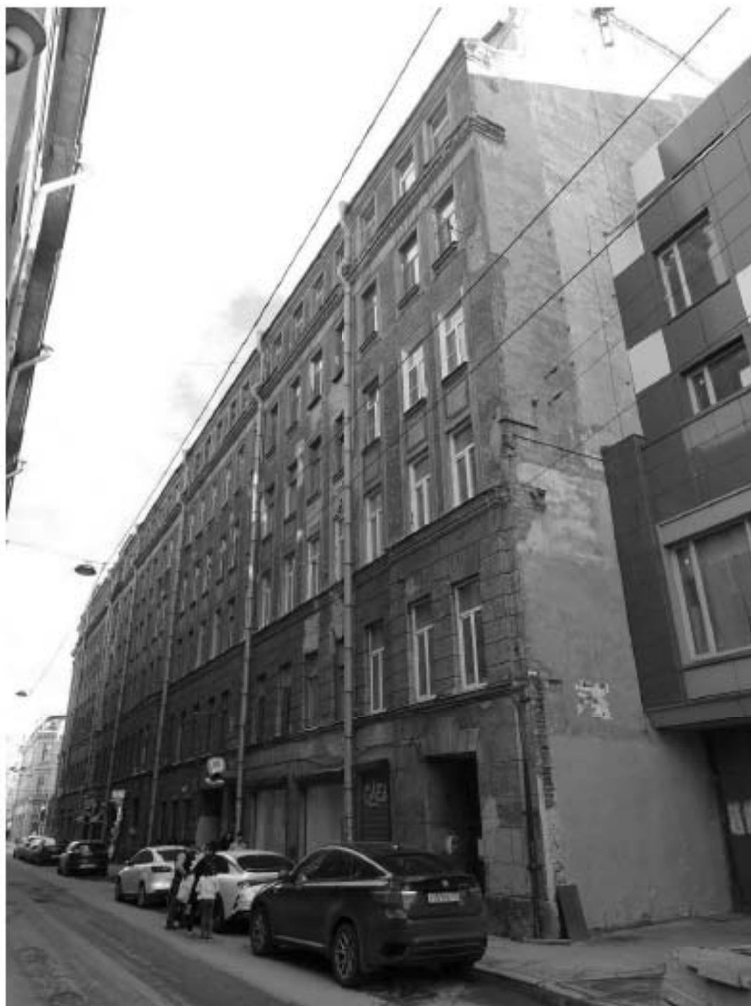
Фото 17. Здание по адресу: г. Санкт-Петербург, Большой проспект П.С., дом 74, литера А. Вид с Бармалеевой ул. с западной стороны. Съемка 19.04.2021 г. Михайловская Г. В.
