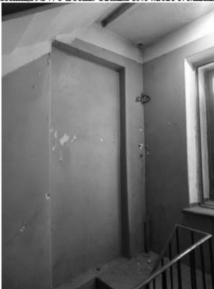
Фото 350. Лестница № 7: 6-й этаж. Съемка 19.04.2021 г. Михайловская Г. В.
