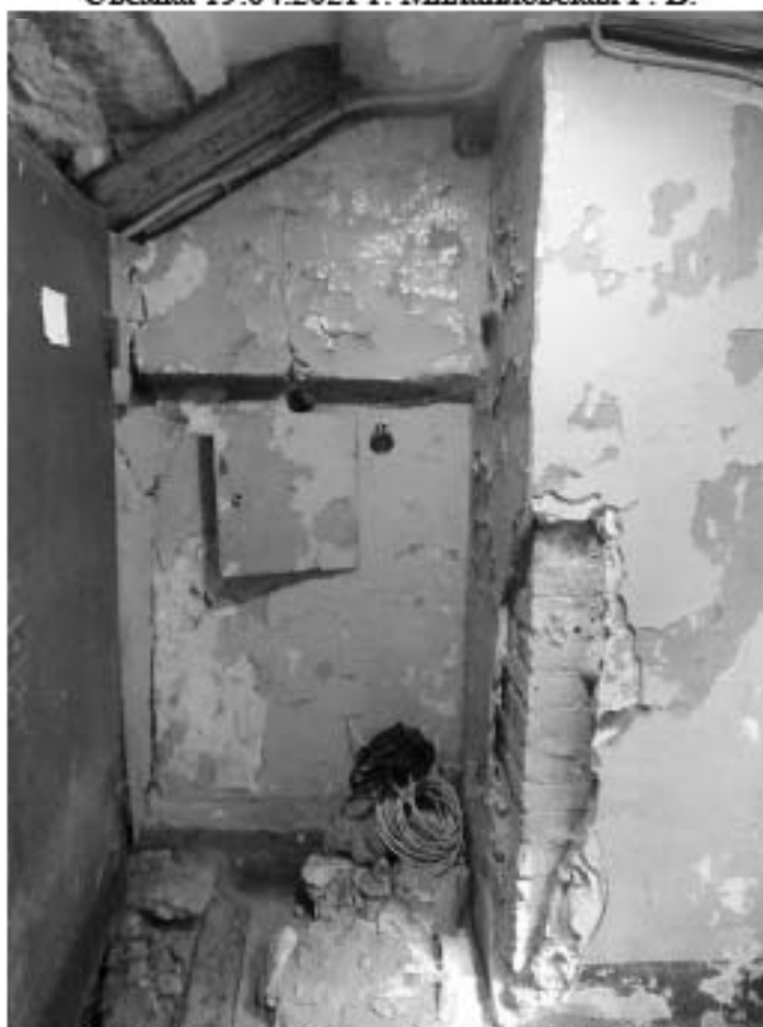
Фото 362. Лестница № 8: 1-й этаж. Ниша. Съемка 19.04.2021 г. Михайловская Г. В.
