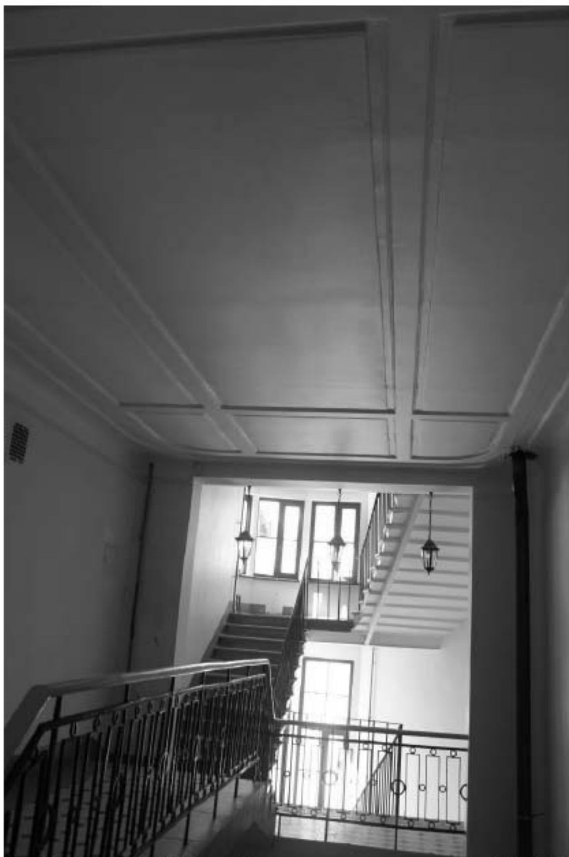
Фото 67. Лестница № 2: 7-й этаж. Переход между лестницами. Съемка 19.04.2021 г. Михайловская Г. В.
