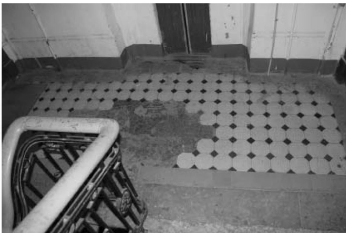
Фото 55. Лестница № 2: 4-й этаж. Покрытие пола. Съемка 19.04.2021 г. Михайловская Г. В.
