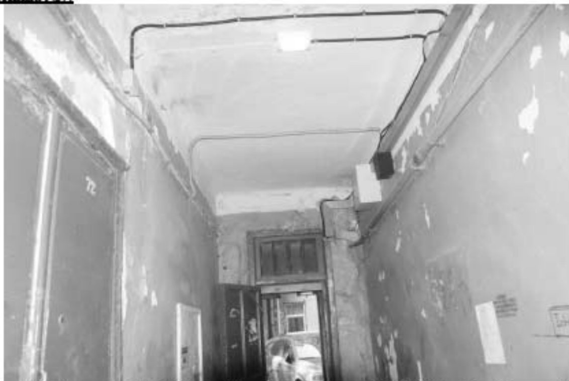
Фото 335. Лестница № 7: 1-й этаж. Вестибюль. Съемка 19.04.2021 г. Михайловская Г. В.
