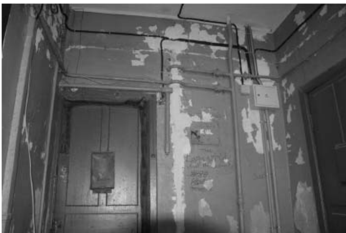
Фото 393. Лестница № 9: 4-й этаж. Съемка 19.04.2021 г. Михайловская Г. В.
