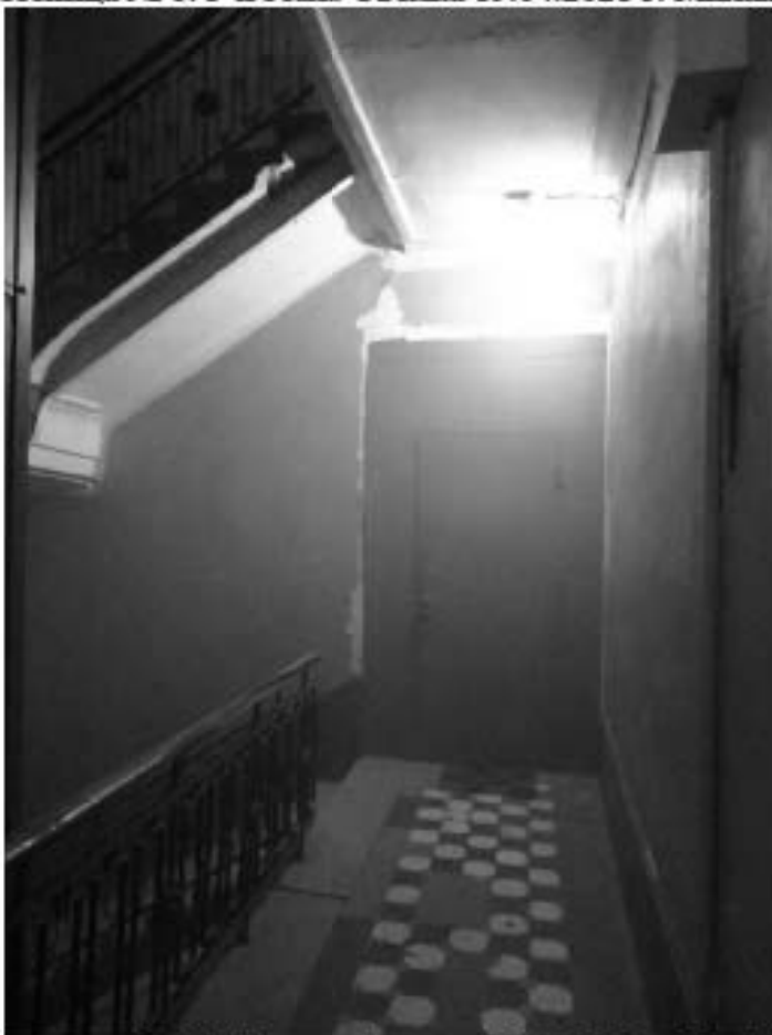
Фото 318. Лестница № 6: 3-й этаж. Съемка 19.04.2021 г. Михайловская Г. В.
