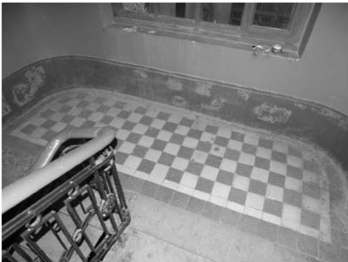
Фото 225. Лестница № 3: Площадка между 6-м и 7-м этажом. Покрытие пола. Съемка 19.04.2021 г. Михайловская Г. В.
