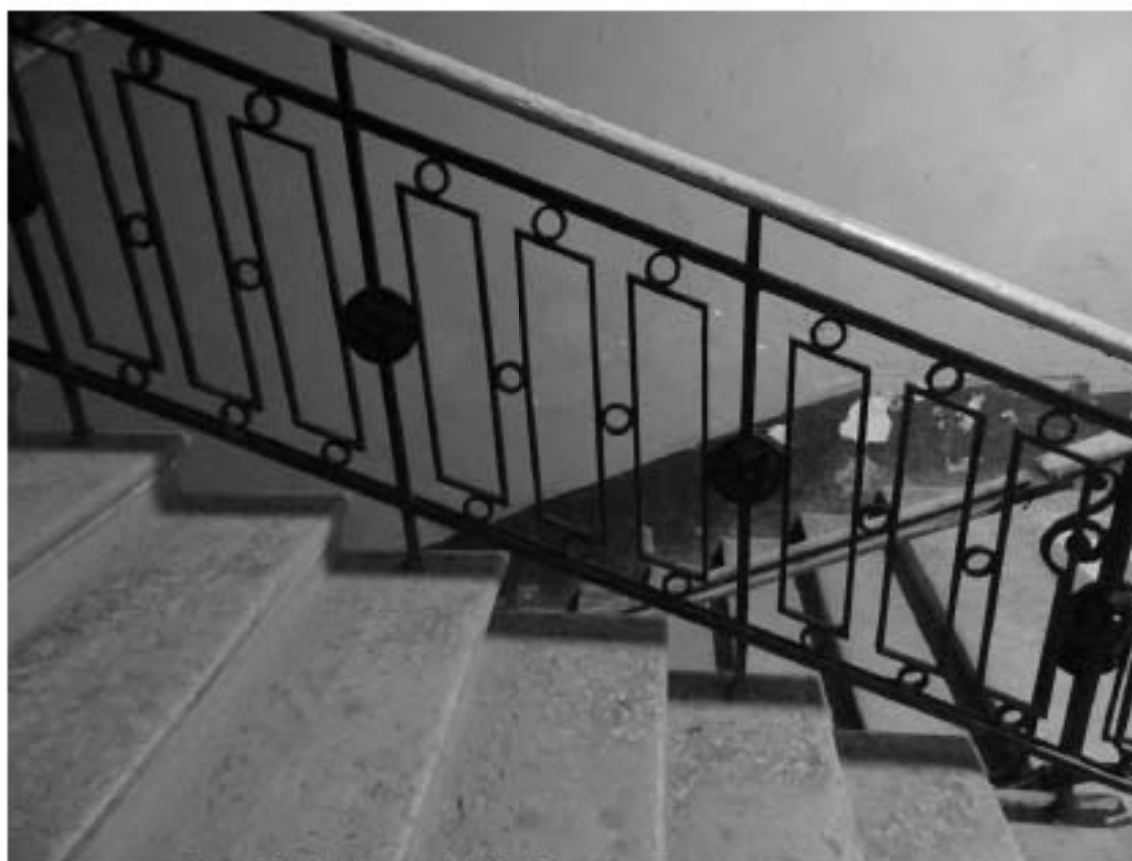
Фото 277. Лестница № 5: Фрагмент ограждения лестницы. Съемка 19.04.2021 г. Михайловская Г. В.
