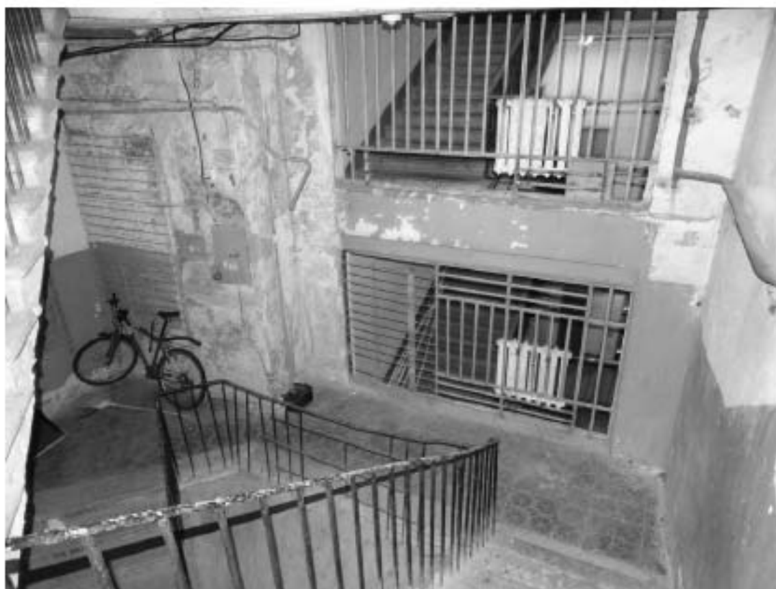
Фото 92. Лестница № 11: Площадка 2-го этажа. Съемка 19.04.2021 г. Михайловская Г. В.
