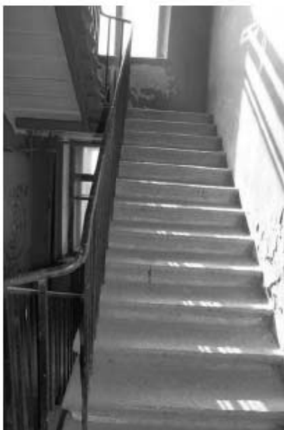
Фото 166. Лестница № 13: Лестничный марш на площадку между 5-м и 6-м этажом. Съемка 19.04.2021 г. Михайловская Г. В.
