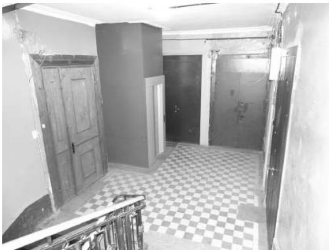
Фото 283. Лестница № 5: 3-й этаж. Оформление потолка. Съемка 19.04.2021 г. Михайловская Г. В.
