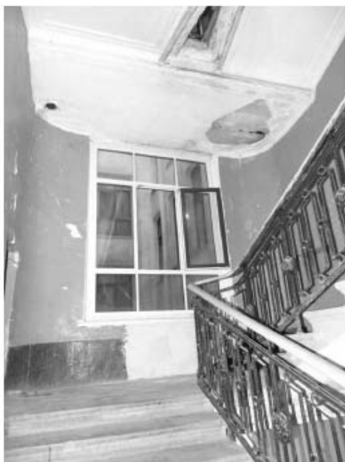
Фото 281. Лестница № 5: Площадка между 2-м и 3-м этажом.
