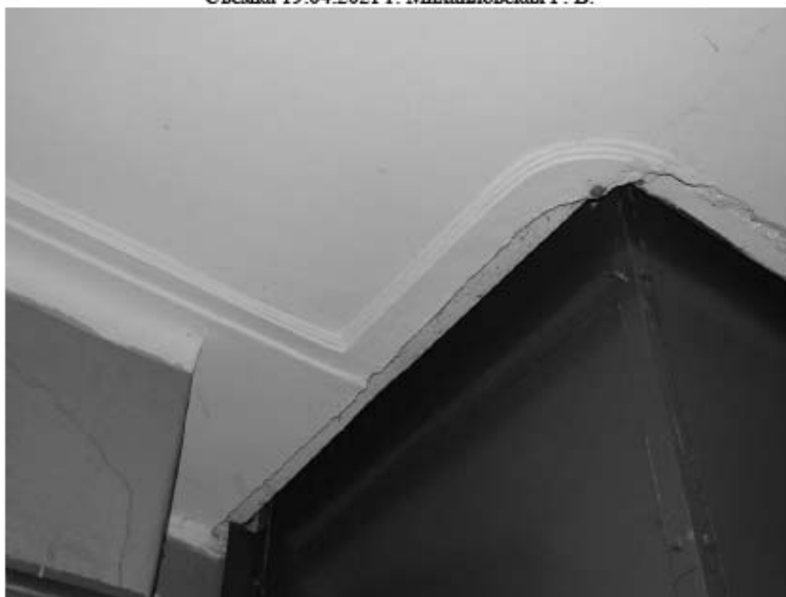
Фото 280. Лестница № 5: 2-й этаж. Оформление потолка. Съемка 19.04.2021 г. Михайловская Г. В.
