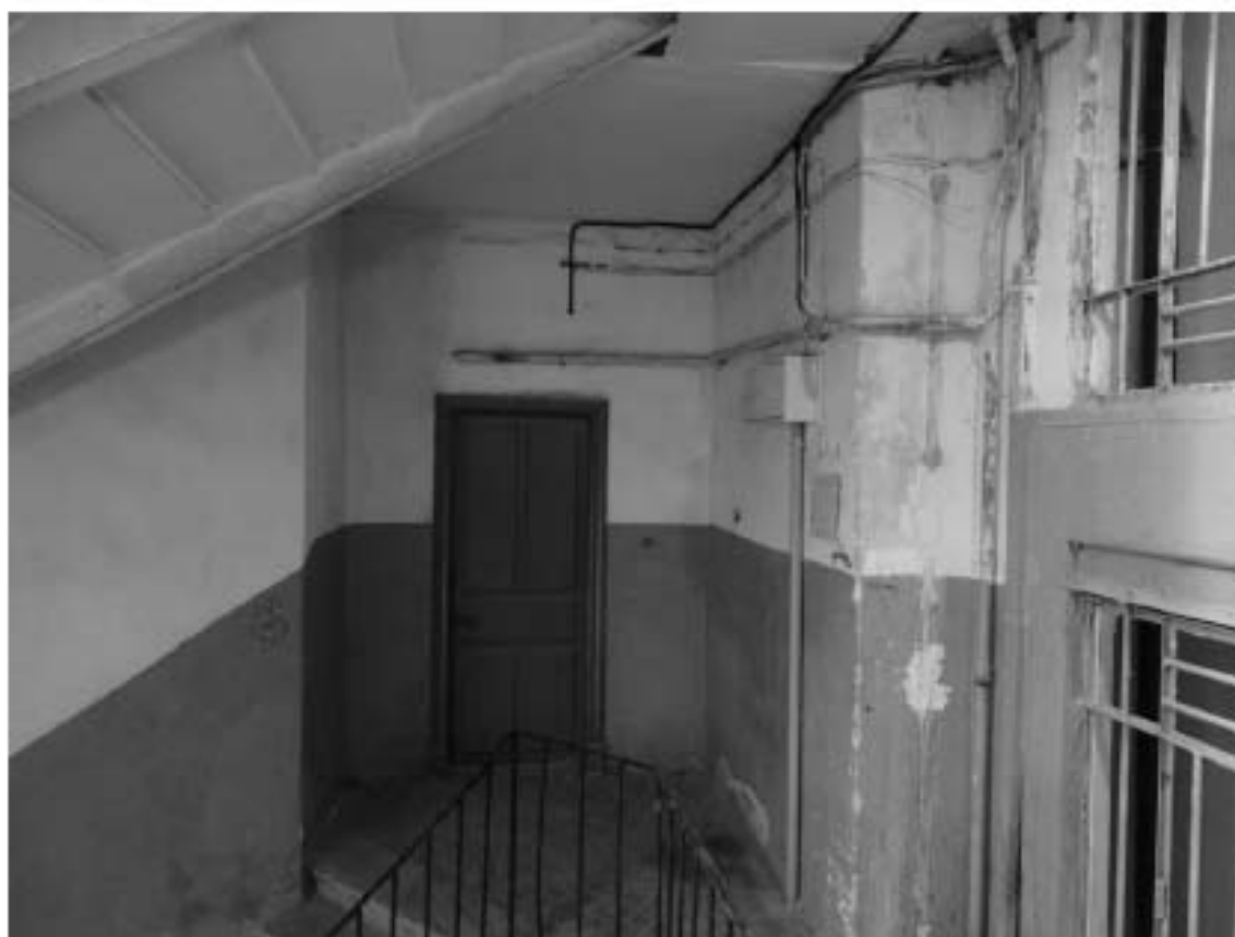
Фото 100. Лестница № 11: Площадка 4-го этажа. Съемка 19.04.2021 г. Михайловская Г. В.
