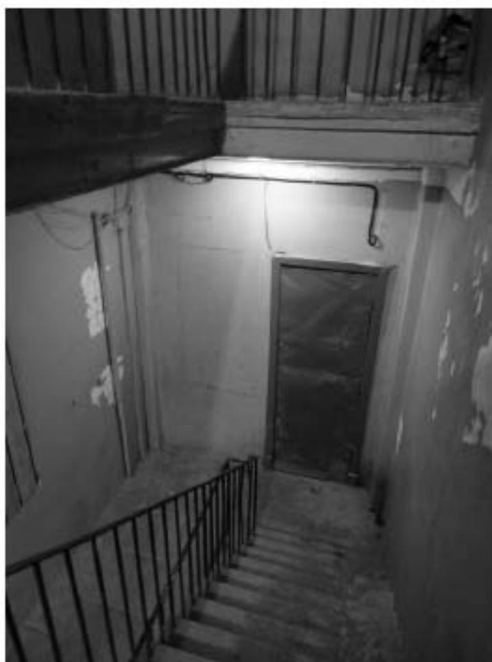
Фото 354. Лестница № 7: 7-й этаж. Съемка 19.04.2021 г. Михайловская Г. В.
