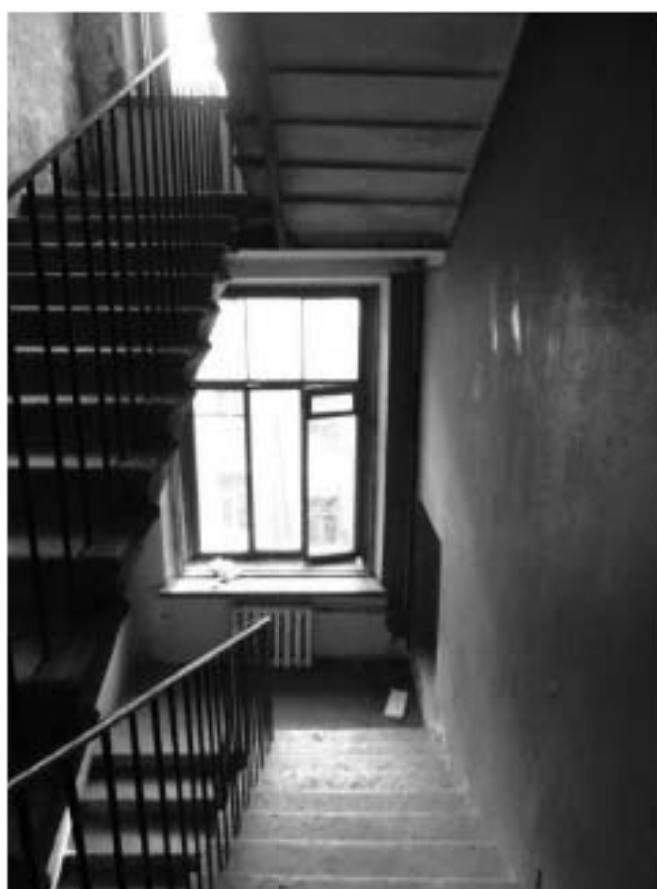
Фото 130. Лестница № 12: Вид на площадку между 3-м и 4-м этажом. Съемка 19.04.2021 г. Михайловская Г. В.
