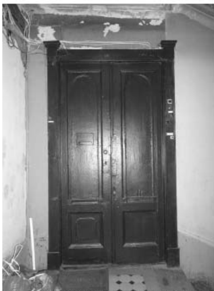
Фото 37. Лестница № 1: Площадка 6-го этажа. Оформление двери. Съемка 19.04.2021 г. Михайловская Г. В.
