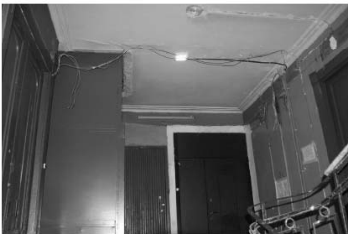
Фото 289. Лестница № 5: 5-й этаж. Съемка 19.04.2021 г. Михайловская Г. В.
