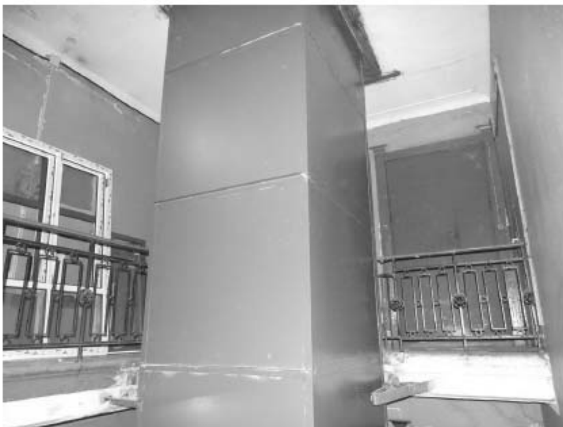
Фото 334. Лестница № 6: 7-й этаж. Съёмка 19.04.2021 г. Михайловская Г. В.
