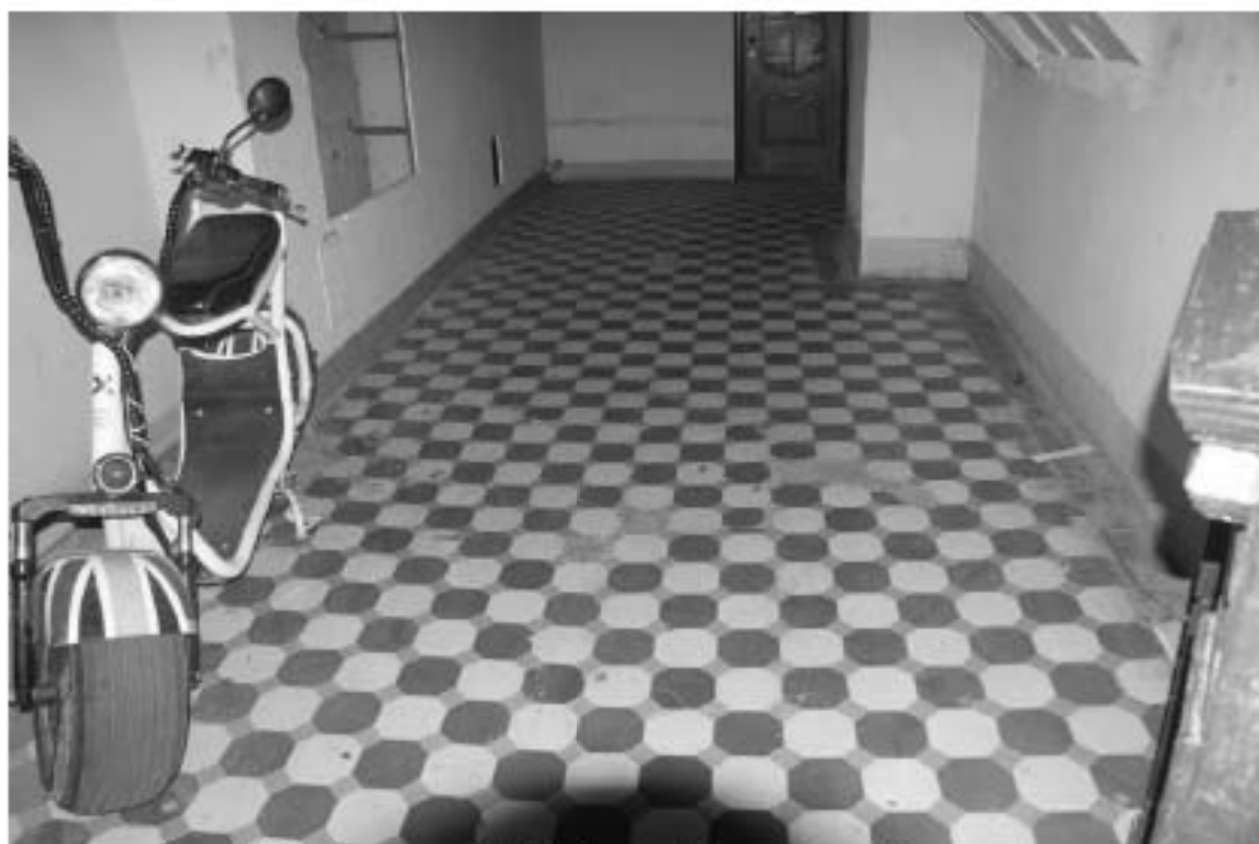
Фото 233. Лестница № 4: 1-й этаж. Вестибюль. Покрытие пола. Съемка 19.04.2021 г. Михайловская Г. В.
