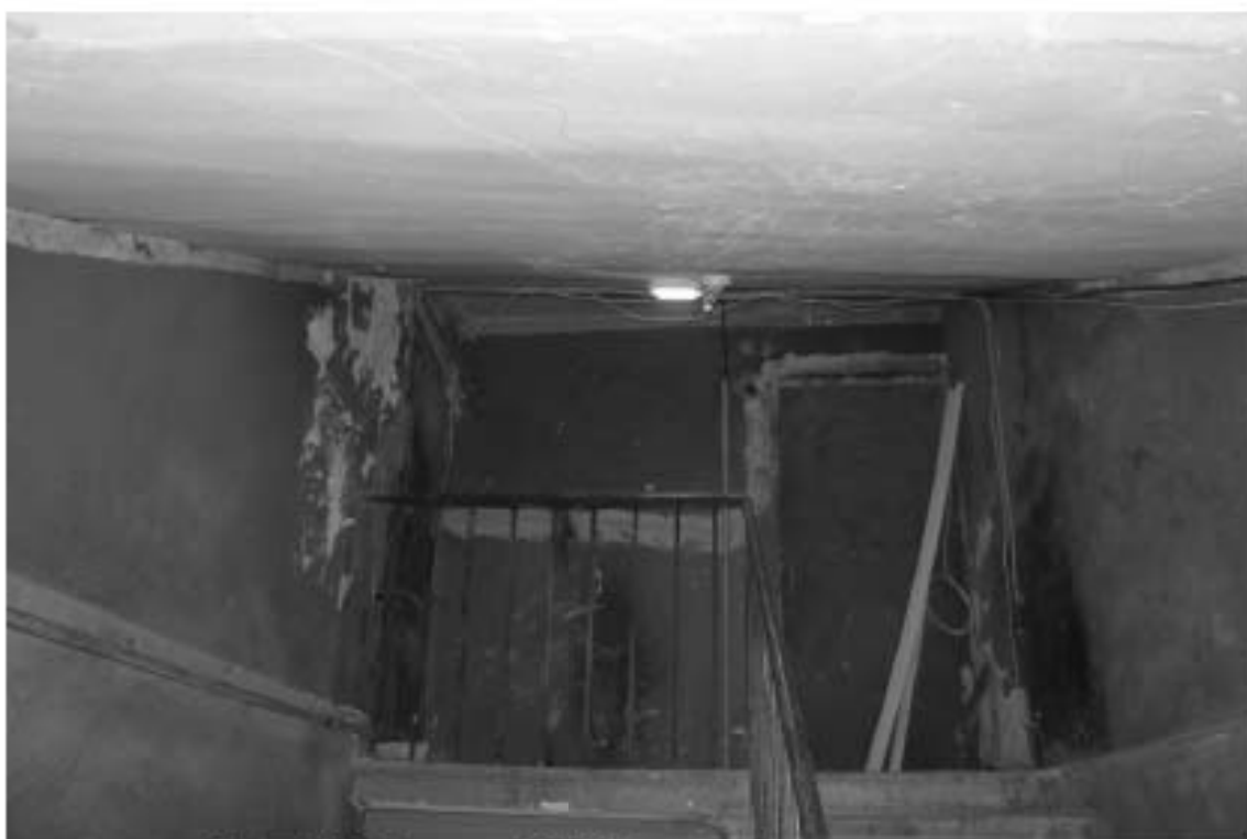
Фото 173. Лестница № 13: Площадка чердачного этажа. Съемка 19.04.2021 г. Михайловская Г. В.
