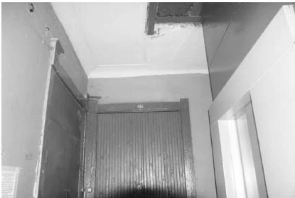
Фото 310. Лестница № 6: 2-й этаж. Съемка 19.04.2021 г. Михайловская Г. В.
