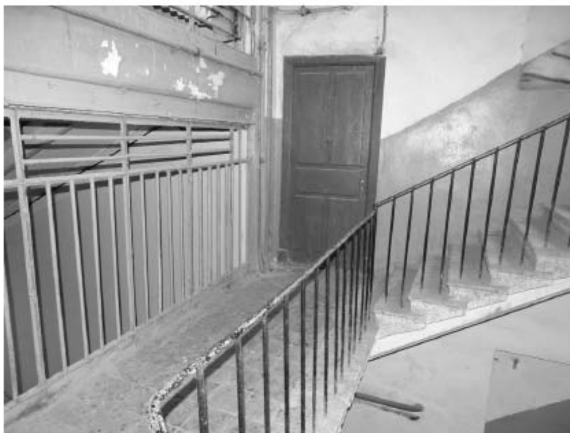
Фото 96. Лестница № 11: Площадка 3-го этажа. Съемка 19.04.2021 г. Михайловская Г. В.
