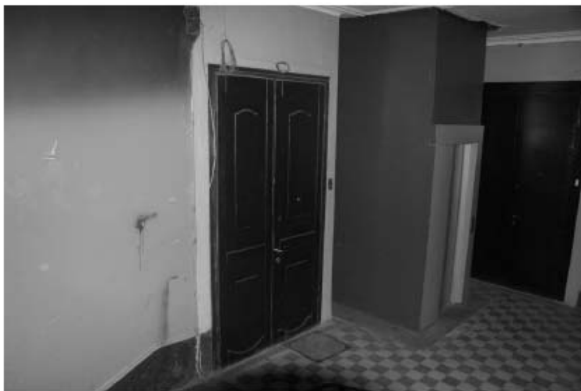
Фото 287. Лестница № 5: 4-й этаж. Съемка 19.04.2021 г. Михайловская Г. В.
