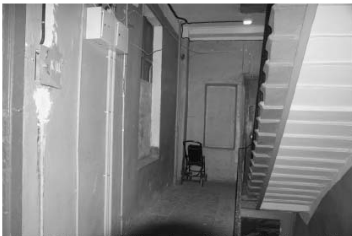
Фото 345. Лестница № 7: 4-й этаж. Съёмка 19.04.2021 г. Михайловская Г. В.
