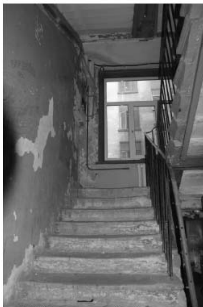
Фото 385. Лестница № 9: Площадка между 1-м и 2-м этажом. Съёмка 19.04.2021 г. Михайловская Г. В.
