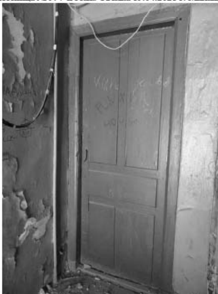
Фото 402. Лестница № 9: 7-й этаж. Съемка 19.04.2021 г. Михайловская Г. В.
