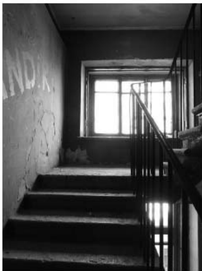
Фото 141. Лестница № 12: Площадка между 7-м и чердачным этажом. Съемка 19.04.2021 г. Михайловская Г. В.
