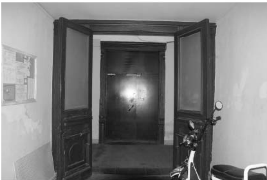
Фото 227. Лестница № 4: 1-й этаж. Входной тамбур. Съемка 19.04.2021 г. Михайловская Г. В.
