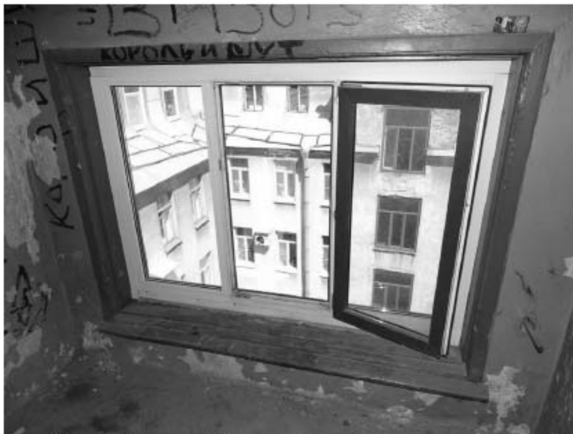
Фото 403. Лестница № 9: Площадка между 7-м и чердачным этажом. Съемка 19.04.2021 г. Михайловская Г. В.
