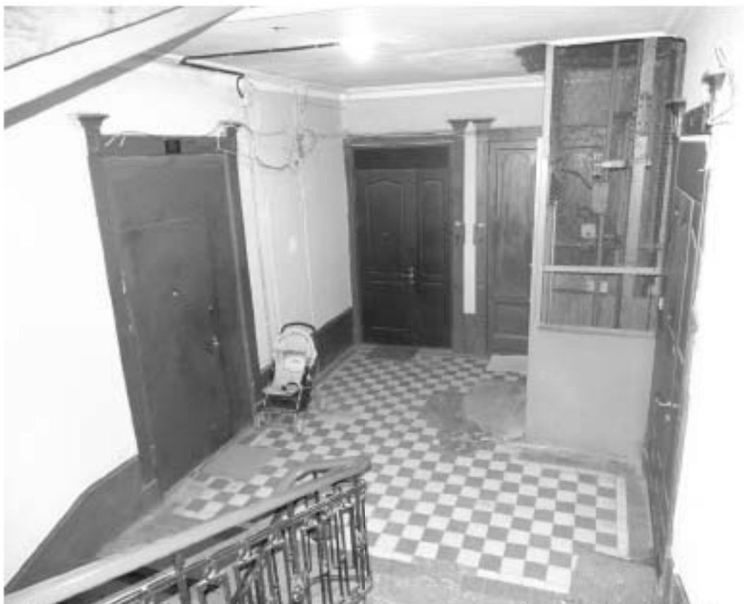
Фото 219. Лестница № 3: Площадка 5-го этажа. Съемка 19.04.2021 г. Михайловская Г. В.
