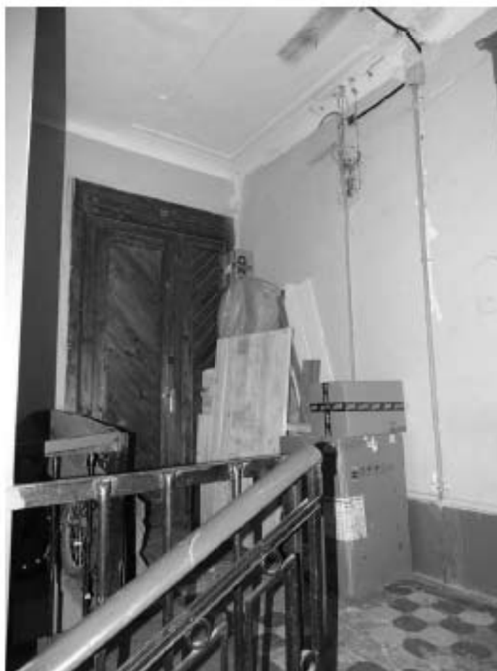
Фото 261. Лестница № 4: 7-й этаж. Съемка 19.04.2021 г. Михайловская Г. В.
