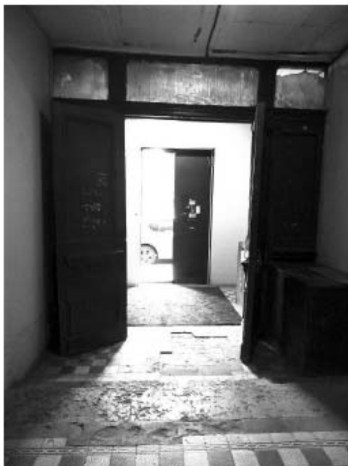
Фото 266. Лестница № 5: 1-й этаж. Входной тамбур. Съемка 19.04.2021 г. Михайловская Г. В.
