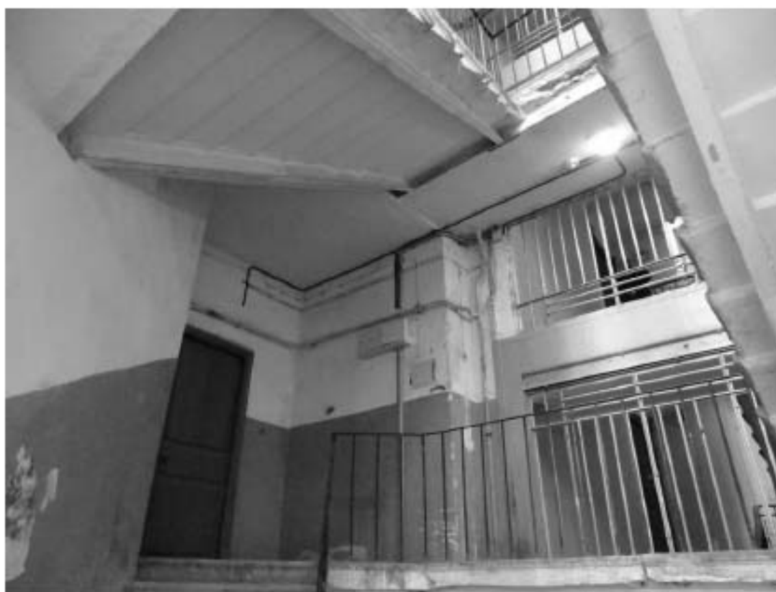
Фото 99. Лестница № 11: Вид на площадку 4-го этажа. Съемка 19.04.2021 г. Михайловская Г. В.
