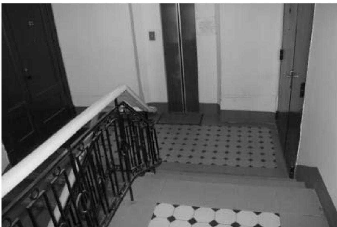
Фото 66. Лестница № 2: 7-й этаж. Съемка 19.04.2021 г. Михайловская Г. В.
