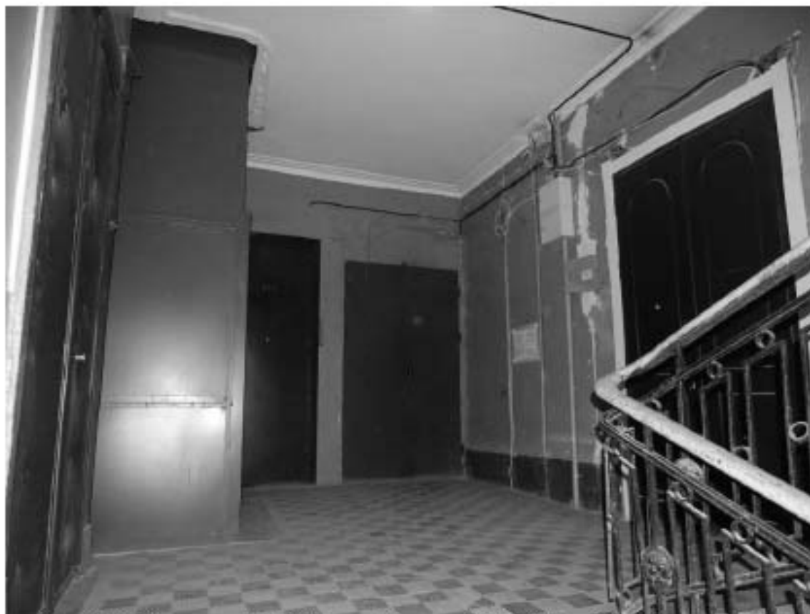
Фото 278. Лестница № 5: 2-й этаж. Съёмка 19.04.2021 г. Михайловская Г. В.
