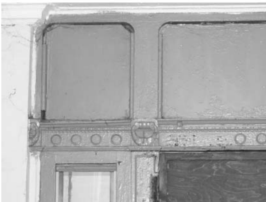
Фото 17. 1-й этаж. Вестибюль по Большому проспекту. Оформление двери. Съемка 19.04.2021 г. Михайловская Г. В.
