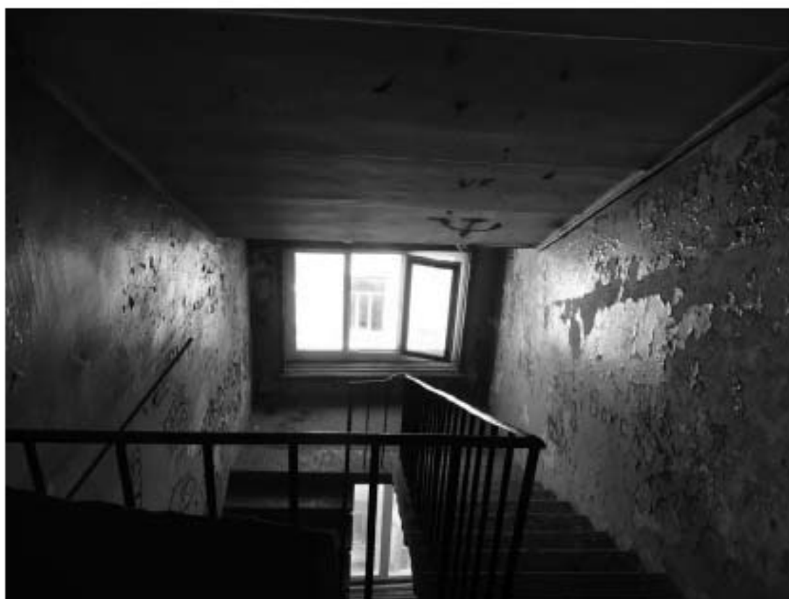
Фото 404. Лестница № 9: Площадка между 7-м и чердачным этажом. Съемка 19.04.2021 г. Михайловская Г. В.
