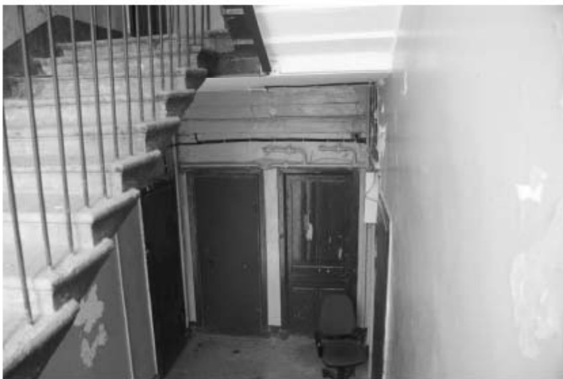
Фото 377. Лестница № 8: 6-й этаж. Съёмка 19.04.2021 г. Михайловская Г. В.
