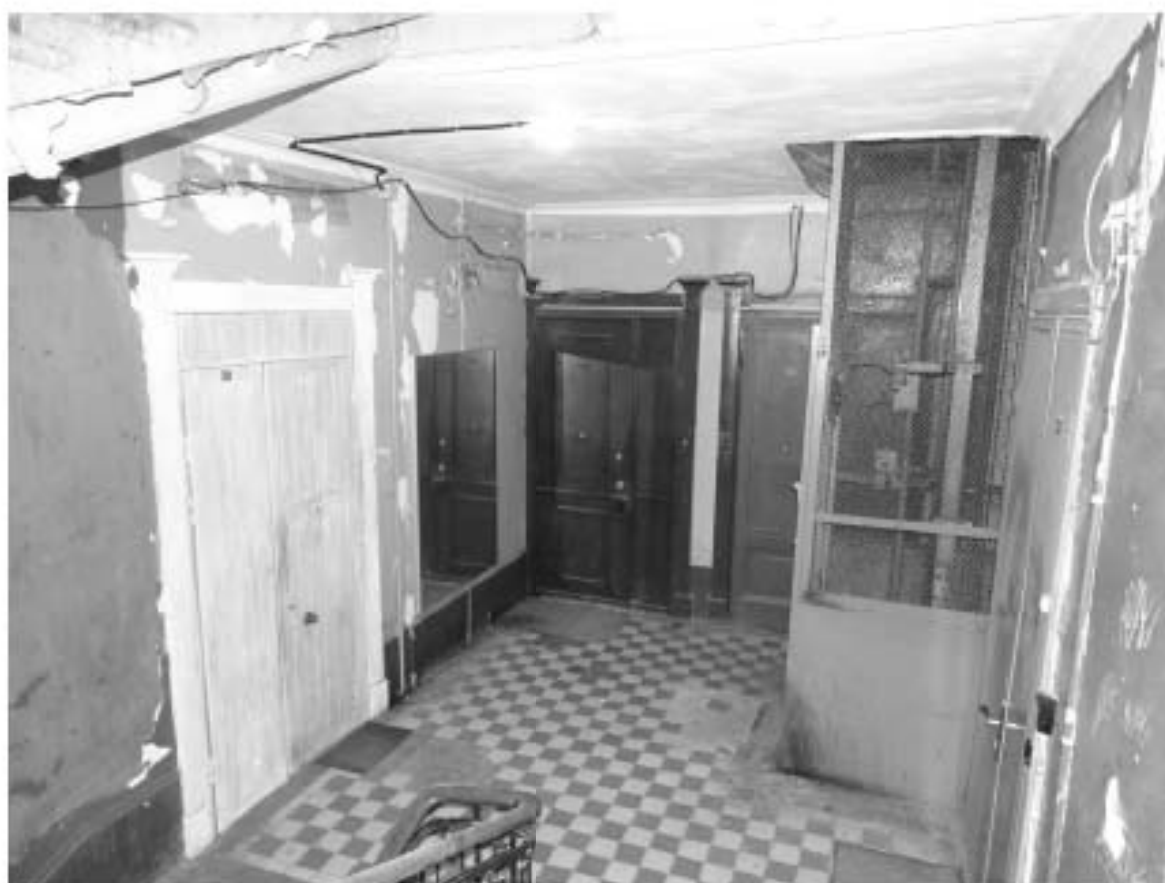
Фото 216. Лестница № 3: Площадка 3-го этажа. Съемка 19.04.2021 г. Михайловская Г. В.
