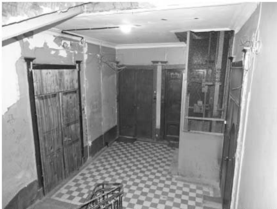
Фото 218. Лестница № 3: Площадка 4-го этажа. Съемка 19.04.2021 г. Михайловская Г. В.
