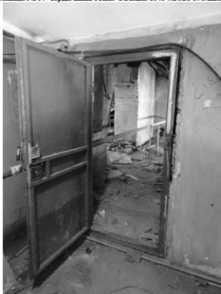
Фото 408. Лестница № 9: Чердачный этаж. Съемка 19.04.2021 г. Михайловская Г. В.
