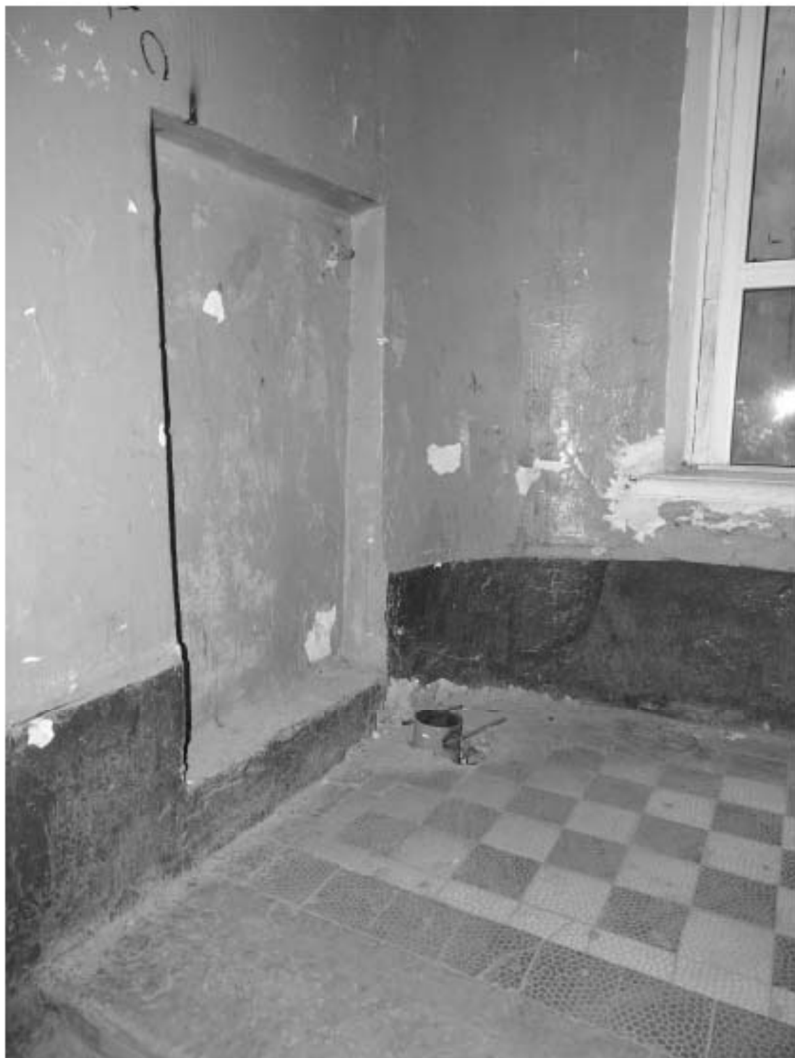
Фото 285. Лестница № 5: Площадка между 3-м и 4-м этажом. Ниша в стене. Съемка 19.04.2021 г. Михайловская Г. В.
