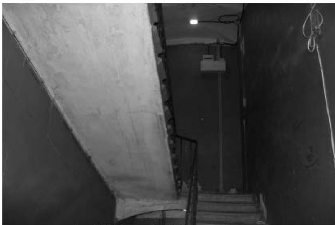
Фото 153. Лестница № 13: Площадка 2-го этажа. Съемка 19.04.2021 г. Михайловская Г. В.
