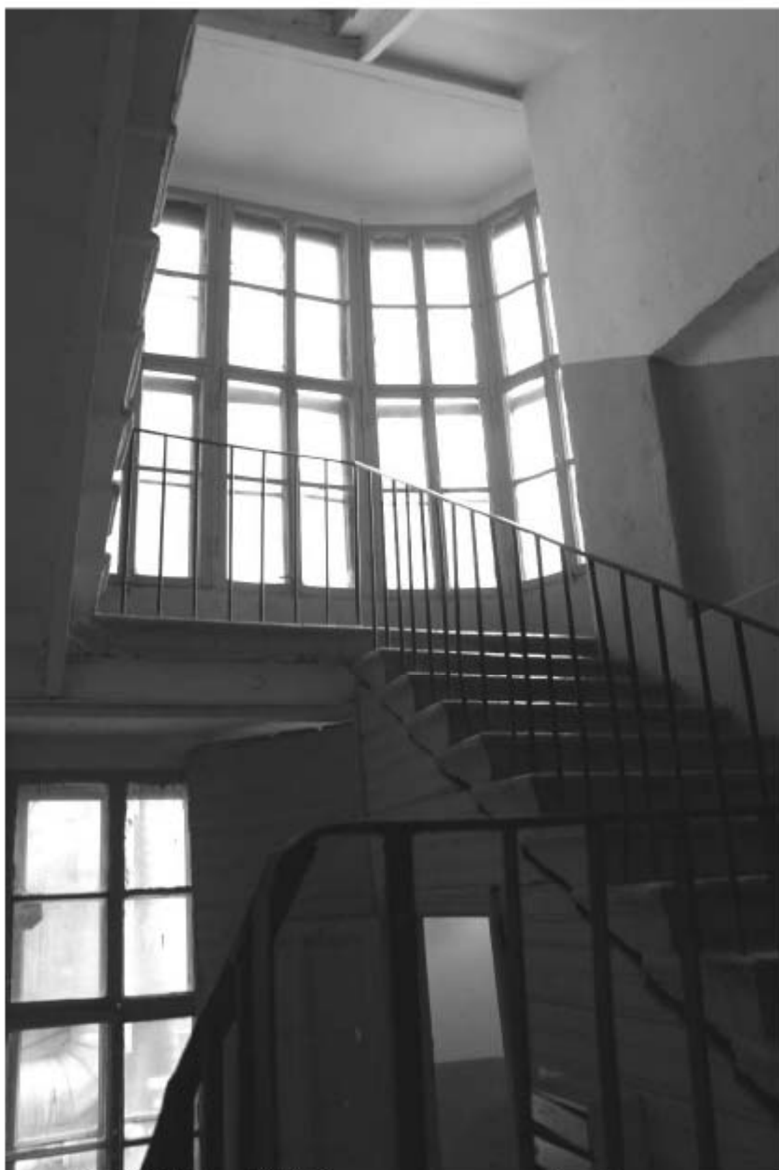
Фото 76. Лестница № 10: Вид на площадку между 2-м и 3-м этажом. Съемка 19.04.2021 г. Михайловская Г. В.
