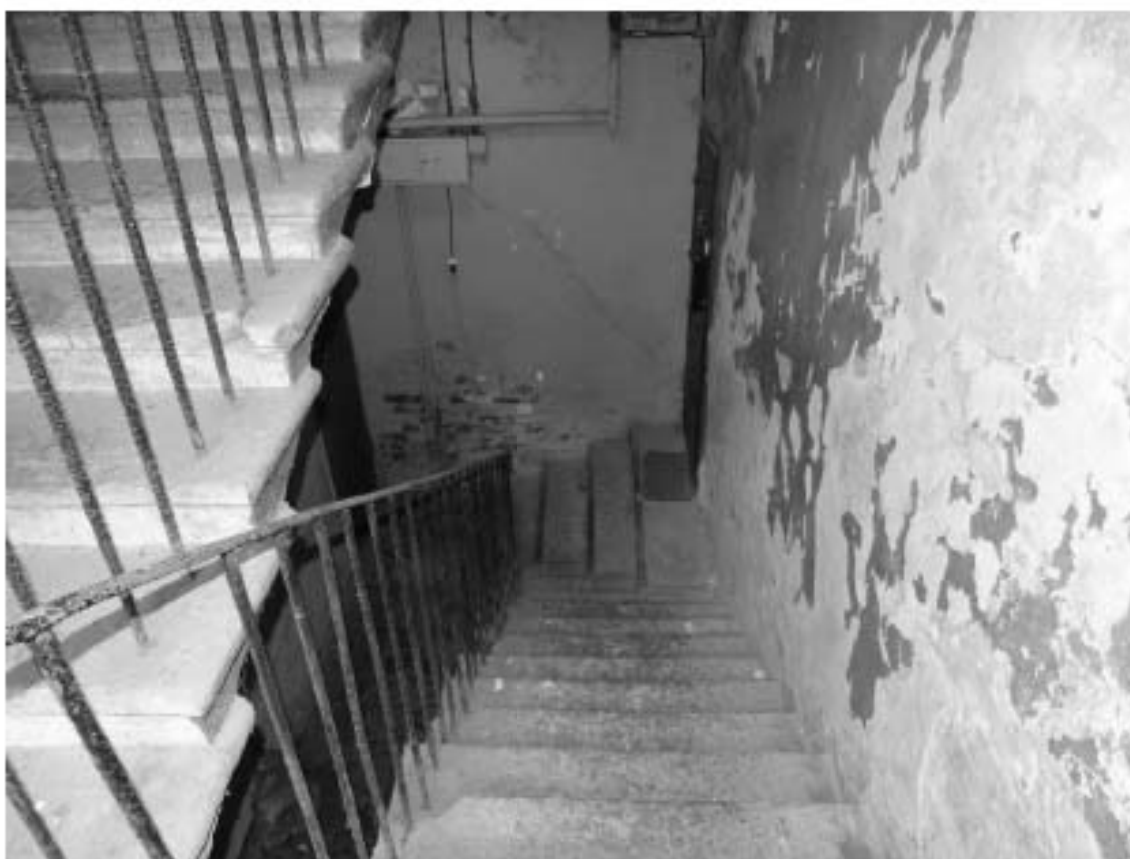
Фото 123. Лестница № 12: Площадка 1-го этажа. Съемка 19.04.2021 г. Михайловская Г. В.
