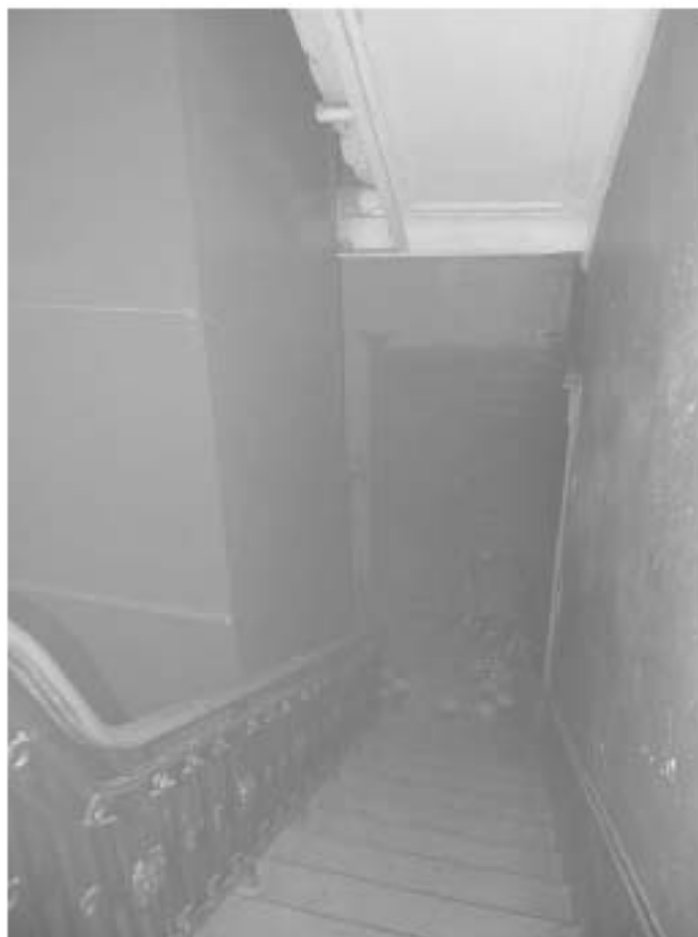
Фото 315. Лестница № 6: 2-й этаж. Съемка 19.04.2021 г. Михайловская Г. В.
