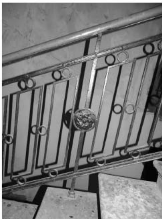
Фото 40. Лестница № 1: Фрагмент лестничного ограждения. Съемка 19.04.2021 г. Михайловская Г. В.
