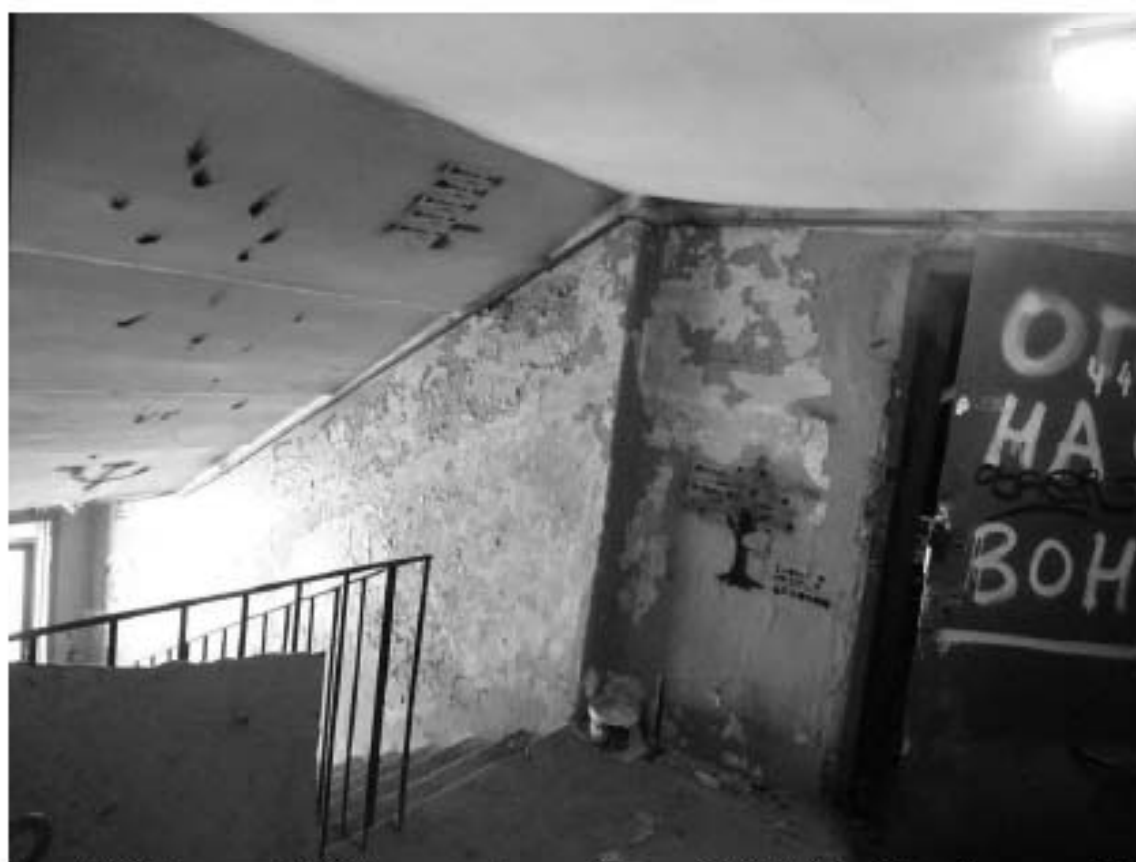
Фото 406. Лестница № 9: Чердачный этаж. Съемка 19.04.2021 г. Михайловская Г. В.
