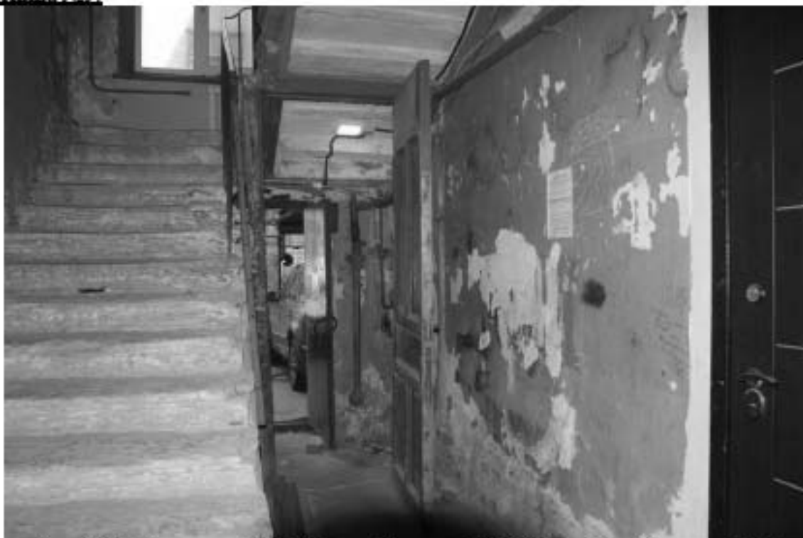
Фото 384. Лестница № 9: 1-й этаж. Съёмка 19.04.2021 г. Михайловская Г. В.
