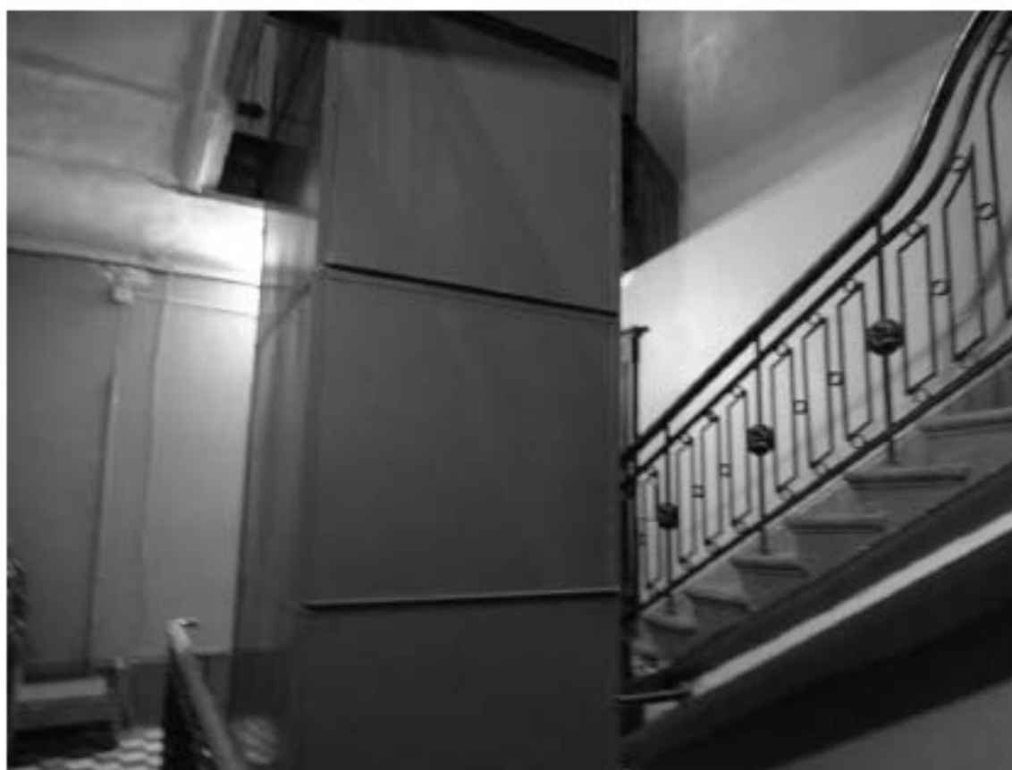
Фото 332. Лестница № 6: 6-й этаж. Съёмка 19.04.2021 г. Михайловская Г. В.
