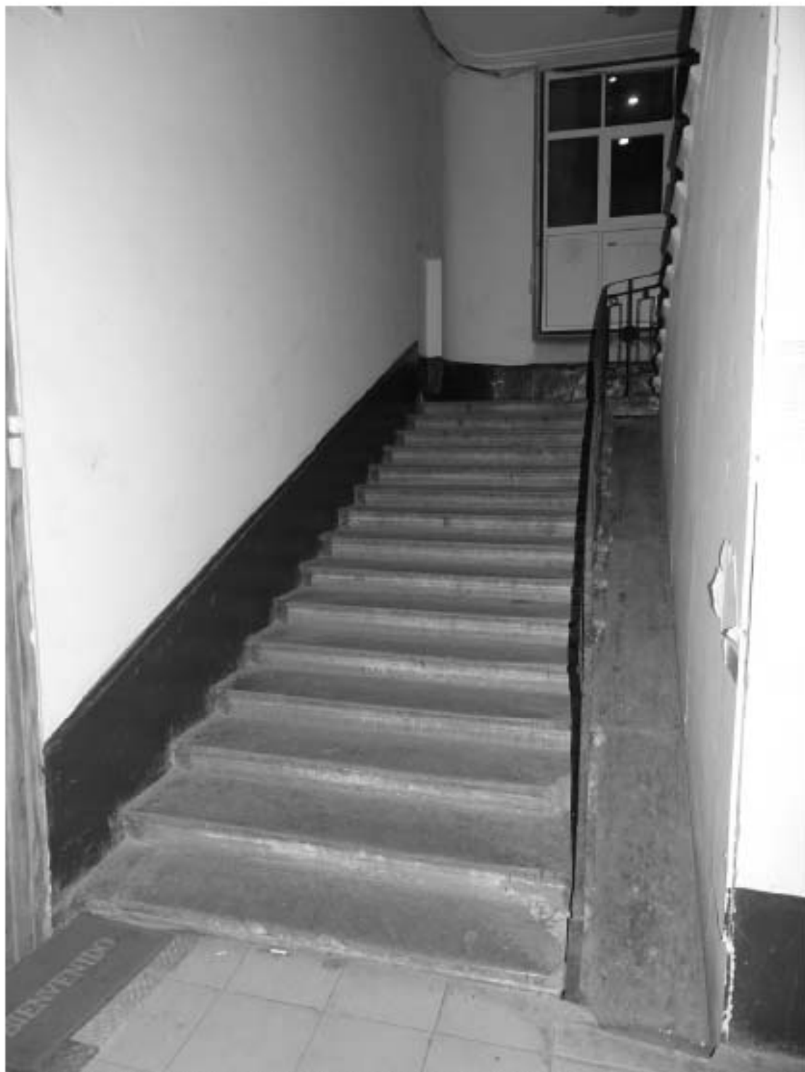
Фото 207. Лестница № 3: 1-й этаж. Вестибюль. Съемка 19.04.2021 г. Михайловская Г. В.
