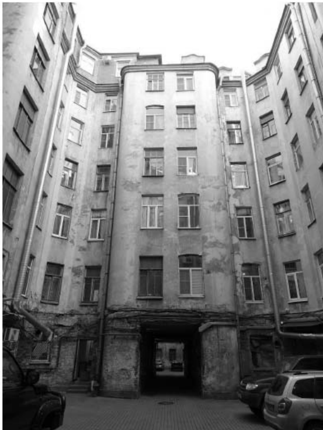
Фото 39. Здание по адресу: г. Санкт-Петербург, Большой проспект П.С., дом 74, литера А. Восточный внутренний двор. Съемка 19.04.2021 г. Михайловская Г. В.
