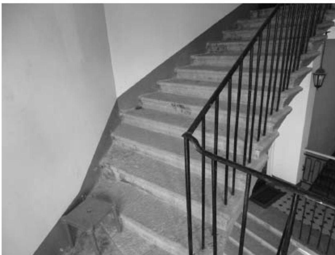
Фото 116. Лестница № 11: Лестничный марш на 8-й этаж. Съемка 19.04.2021 г. Михайловская Г. В.
