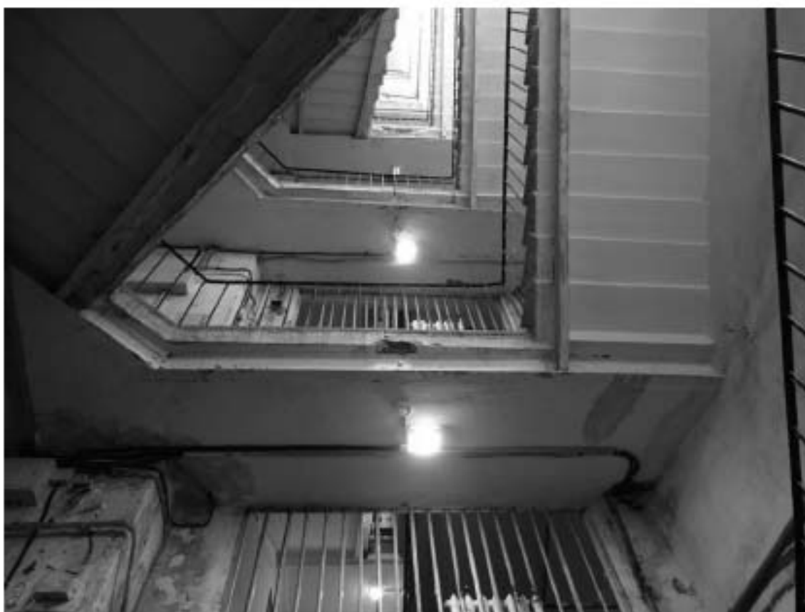
Фото 90. Лестница № 11: Лестничные марши. Съемка 19.04.2021 г. Михайловская Г. В.
