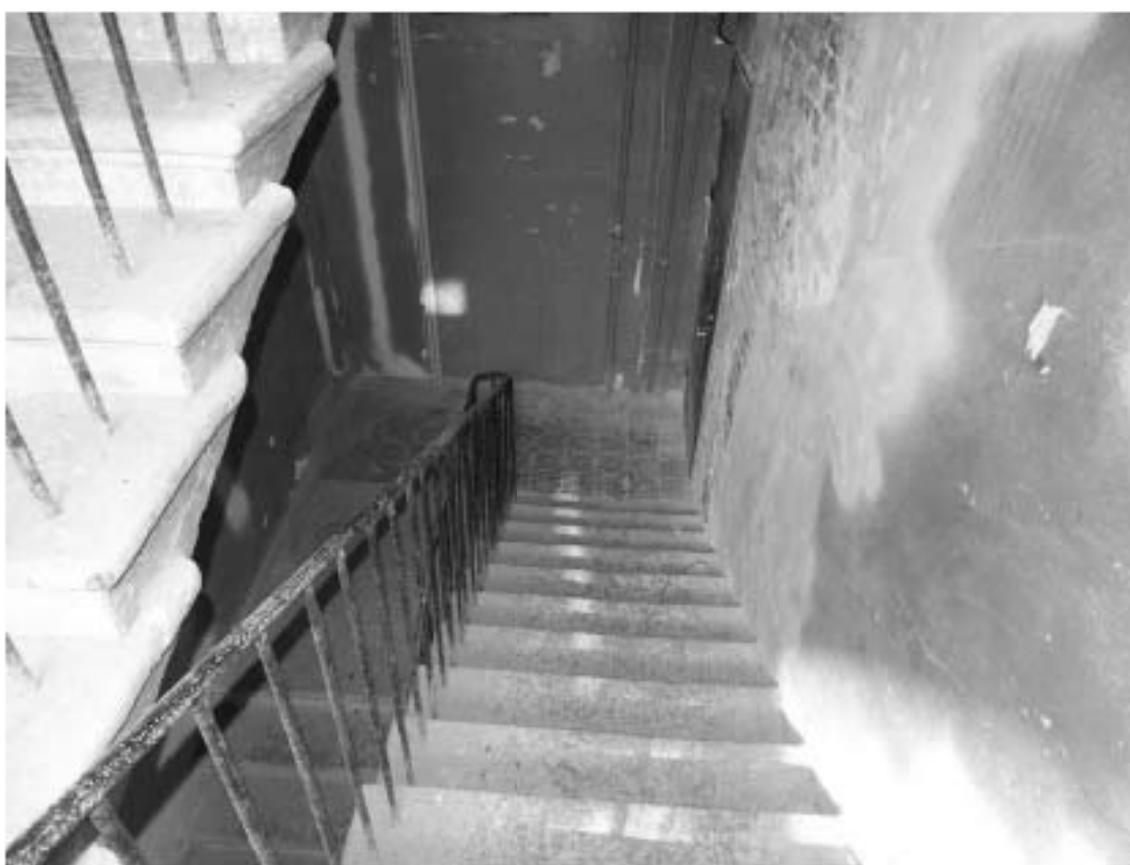
Фото 126. Лестница № 12: Площадка 2-го этажа. Съемка 19.04.2021 г. Михайловская Г. В.
