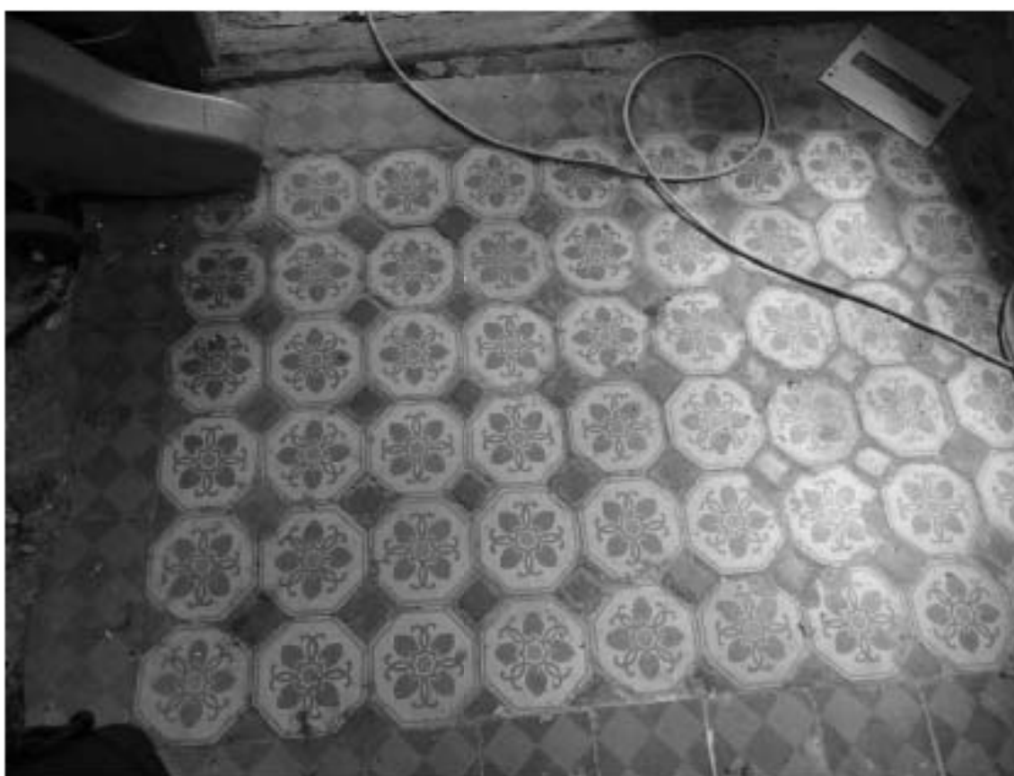
Фото 89. Лестница № 11: Вестибюль. 1-й этаж. Покрытие пола. Съемка 19.04.2021 г. Михайловская Г. В.
