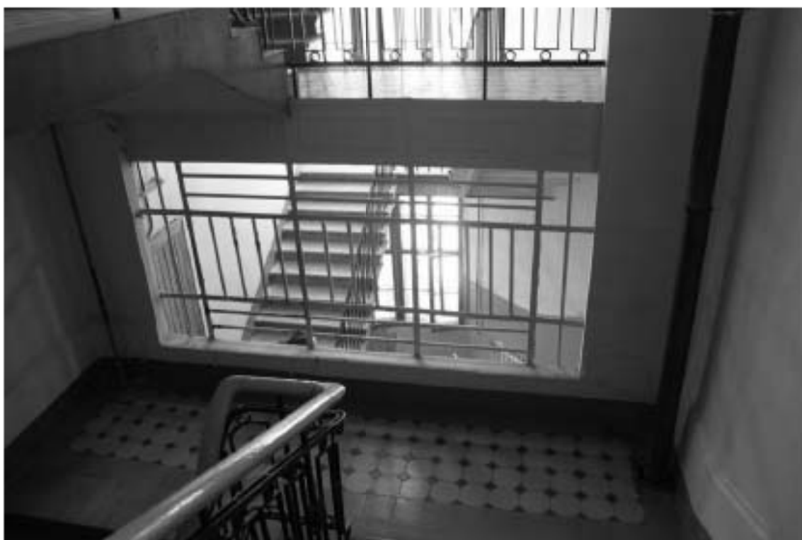
Фото 64. Лестница № 2: Площадка м/у 6-м и 7-м этажом. Съемка 19.04.2021 г. Михайловская Г. В.
