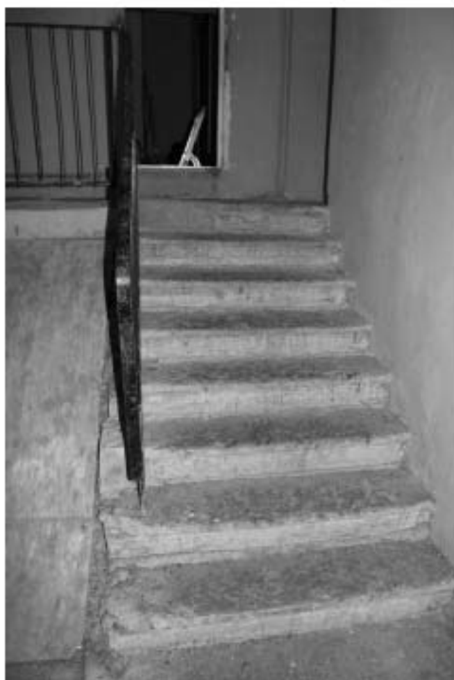
Фото 72. Лестница № 10: Лестничный марш на площадку 2-го этажа. Съемка 19.04.2021 г. Михайловская Г. В.
