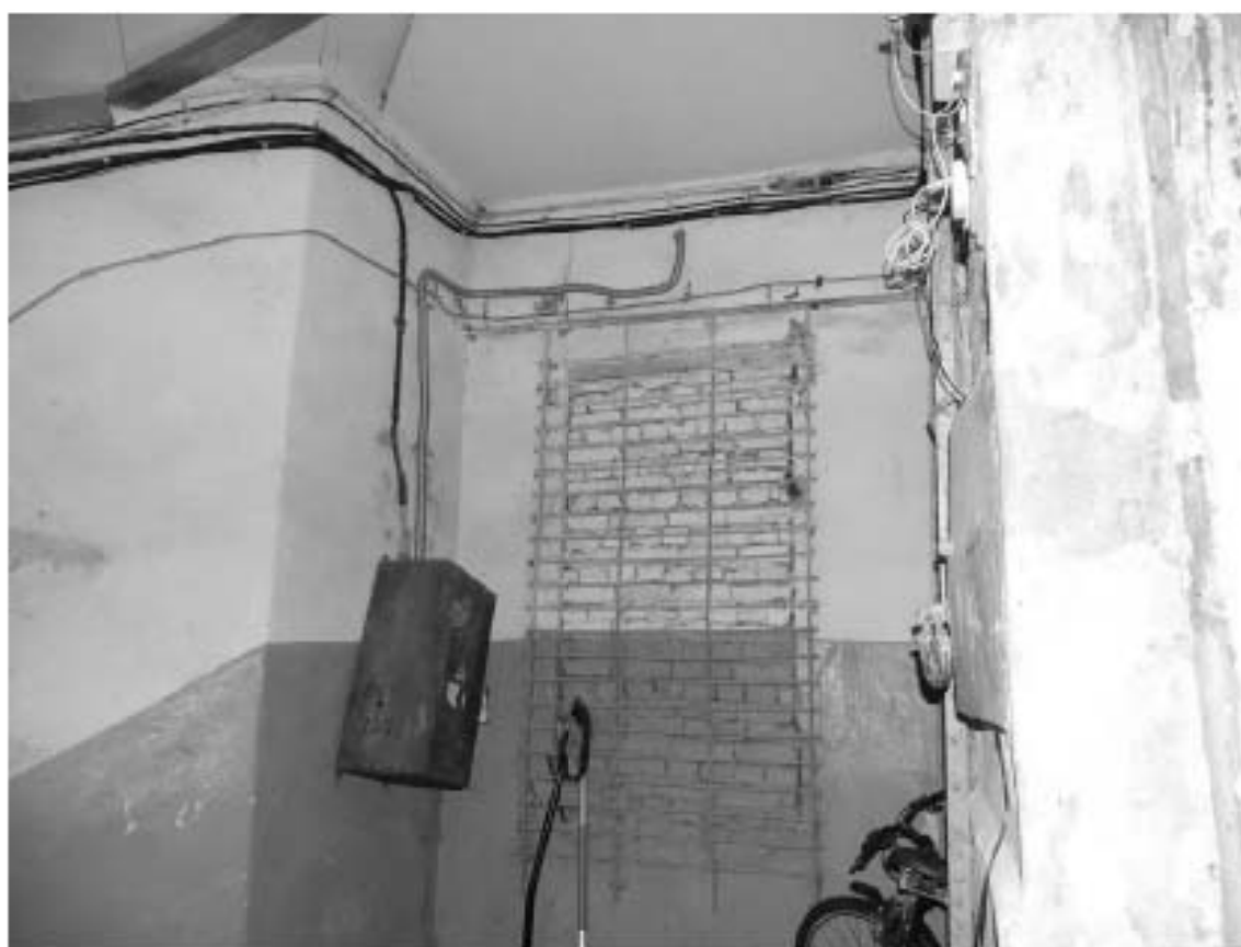
Фото 93. Лестница № 11: Площадка 2-го этажа. Съемка 19.04.2021 г. Михайловская Г. В.
