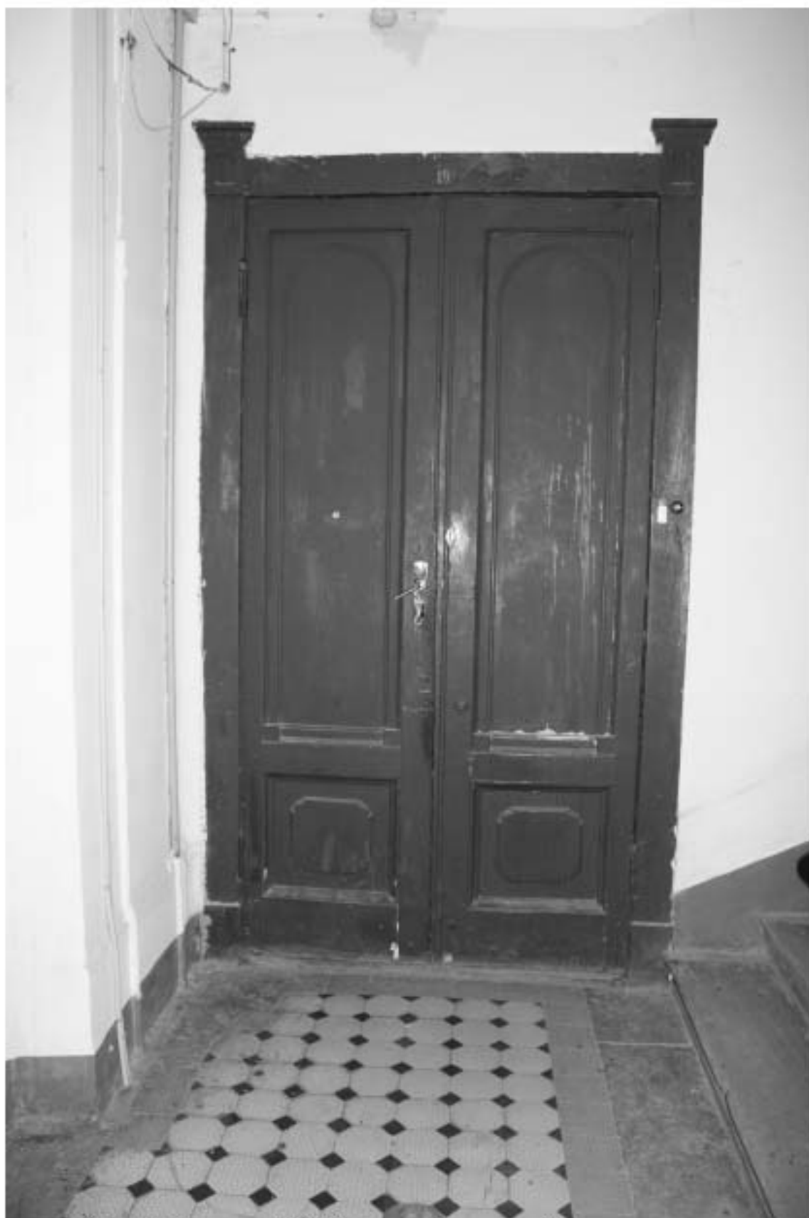
Фото 58. Лестница № 2: Площадка 5-го этажа. Оформление двери. Съемка 19.04.2021 г. Михайловская Г. В.
