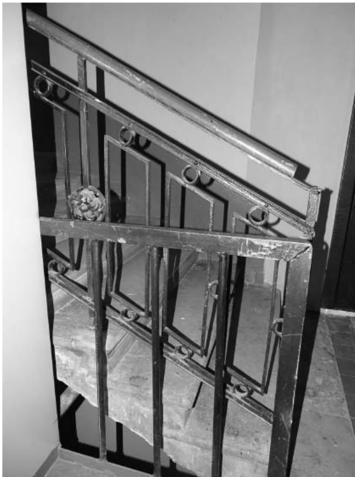
Фото 246. Лестница № 4: Фрагмент лестничного ограждения. Съемка 19.04.2021 г. Михайловская Г. В.
