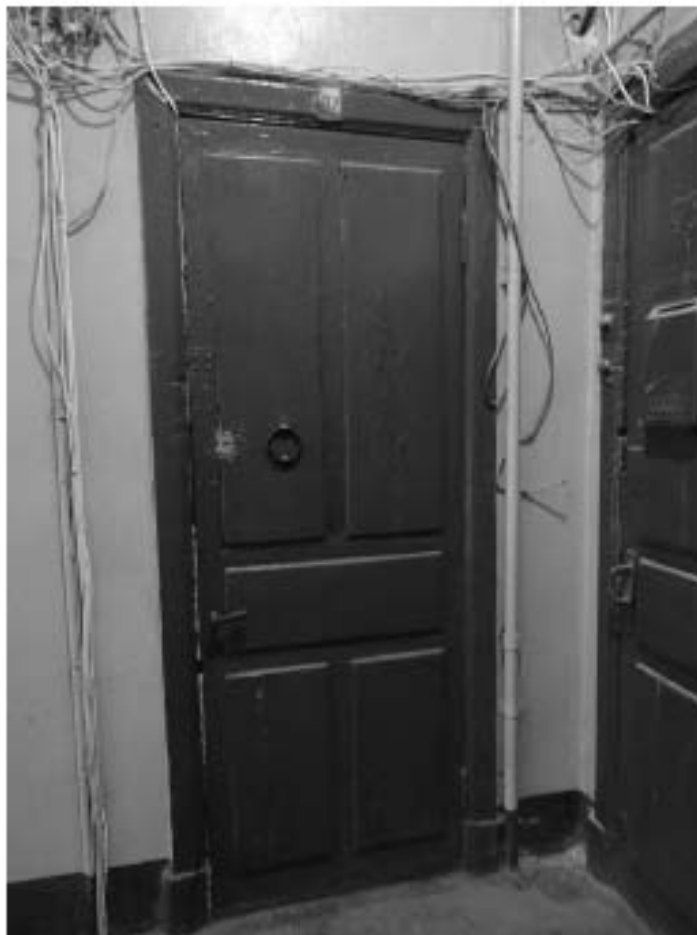
Фото 367. Лестница № 8: 2-й этаж. Съемка 19.04.2021 г. Михайловская Г. В.
