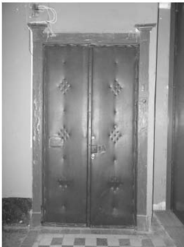
Фото 279. Лестница № 5: 2-й этаж. Заполнение дверного проема.
