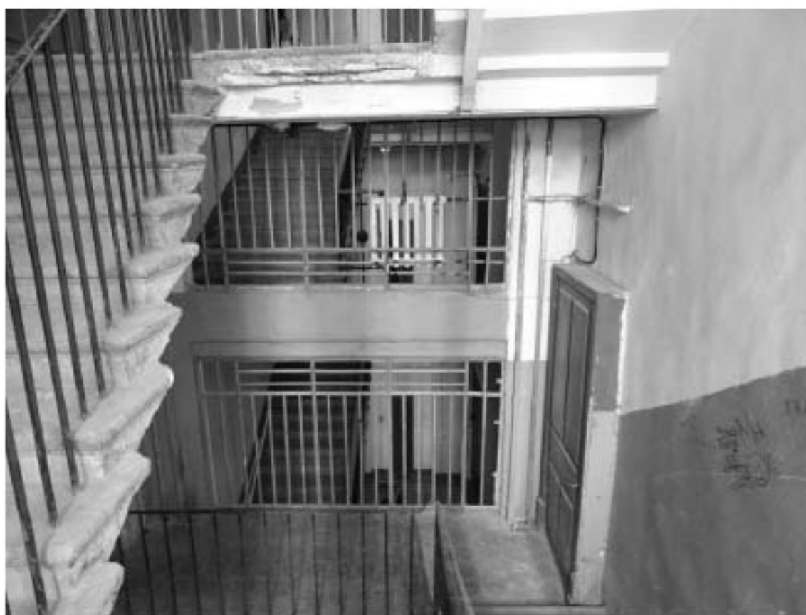
Фото 101. Лестница № 11: Площадка 4-го этажа. Съемка 19.04.2021 г. Михайловская Г. В.
