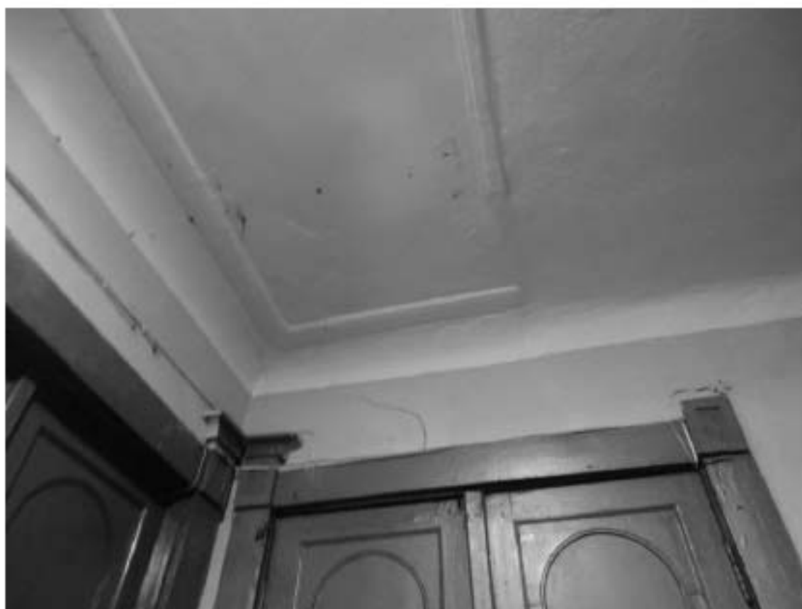
Фото 259. Лестница № 4: 7-й этаж. Оформление потолка. Съемка 19.04.2021 г. Михайловская Г. В.
