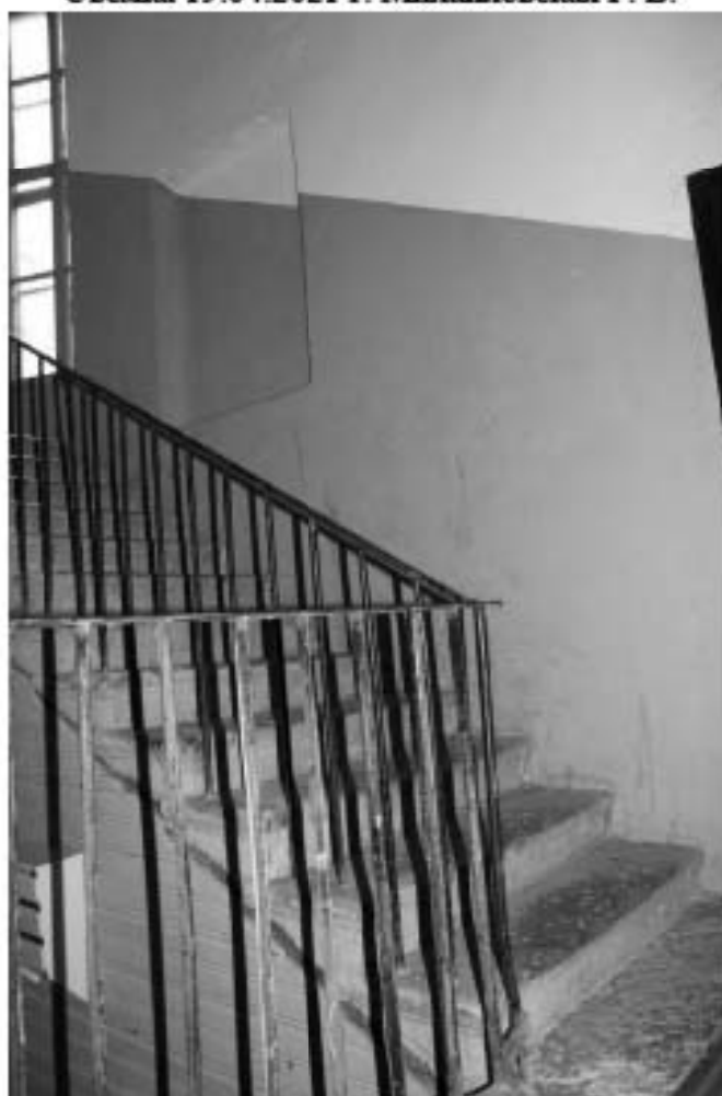
Фото 75. Лестница № 90: Лестничный марш на площадку между 2-м и 3-м этажом. Съемка 19.04.2021 г. Михайловская Г. В.
