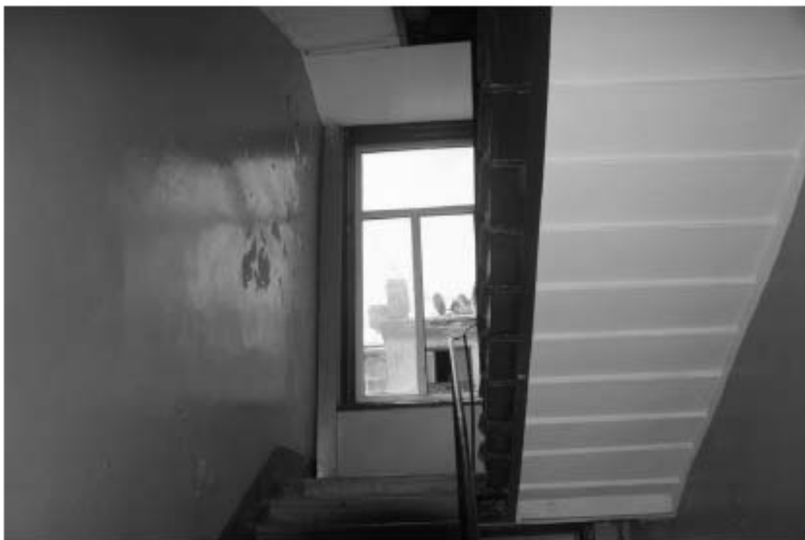
Фото 378. Лестница № 8: Площадка между 6-м и 7-м этажом. Съёмка 19.04.2021 г. Михайловская Г. В.
