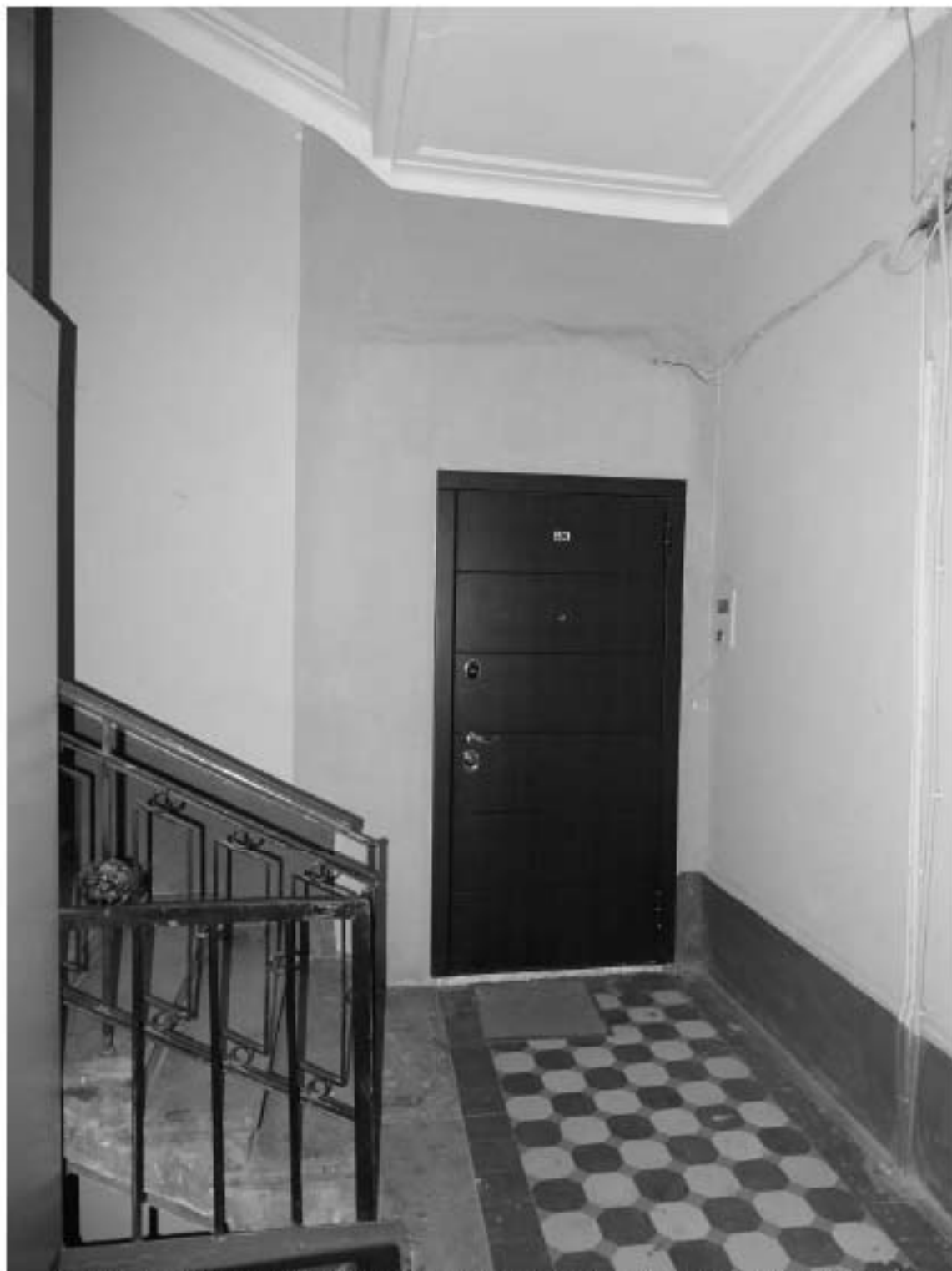
Фото 245. Лестница № 4: 4-й этаж. Съёмка 19.04.2021 г. Михайловская Г. В.
