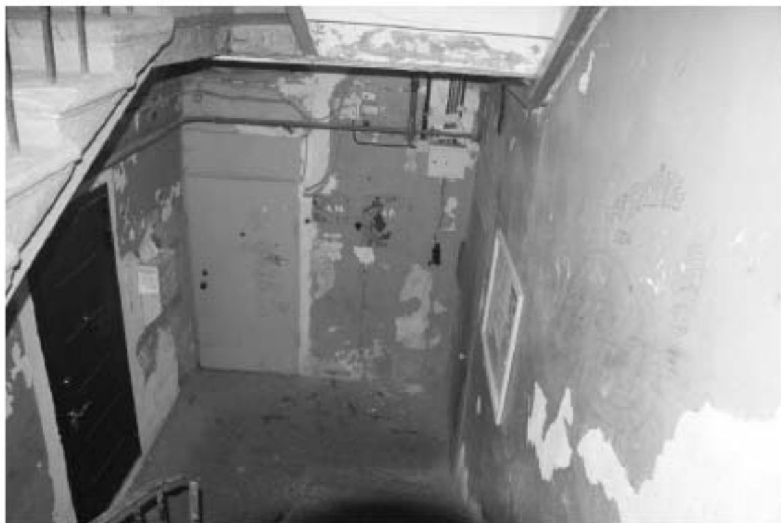
Фото 386. Лестница № 9: 1-й этаж. Съемка 19.04.2021 г. Михайловская Г. В.
