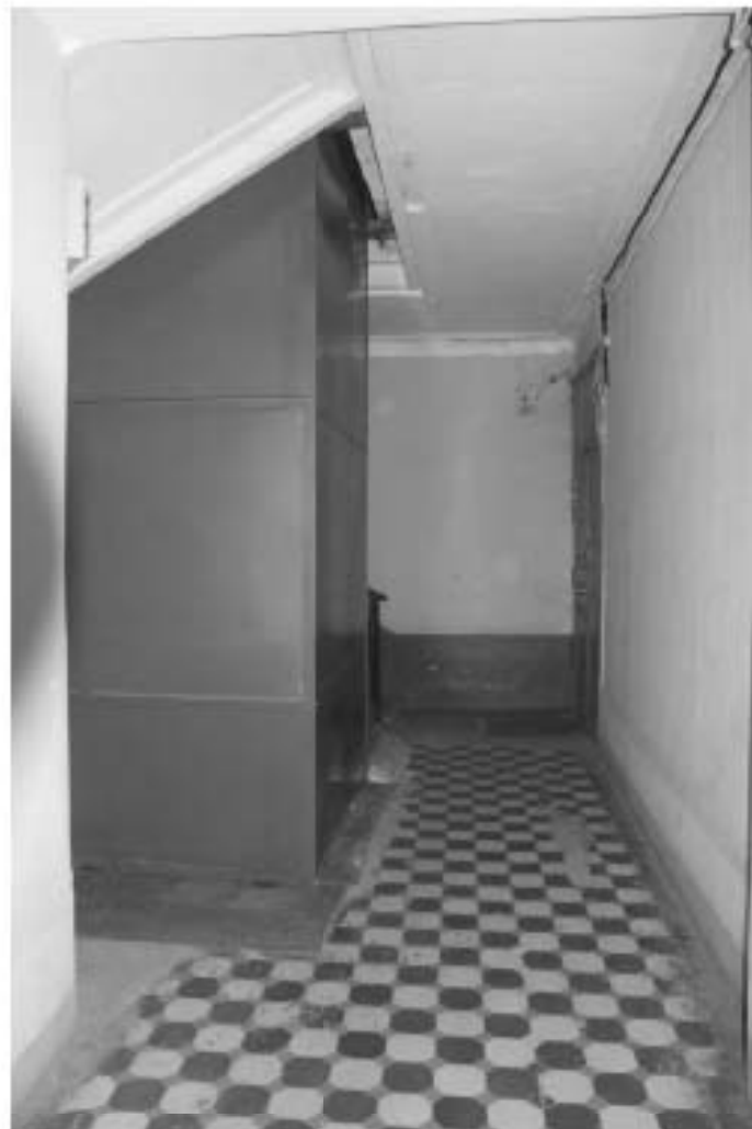
Фото 234. Лестница № 4: 1-й этаж. Вестибюль. Лифтовая шахта. Съемка 19.04.2021 г. Михайловская Г. В.
