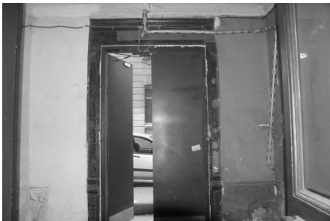
Фото 299. Лестница № 6: 1-й этаж. Вестибюль. Съемка 19.04.2021 г. Михайловская Г. В.
