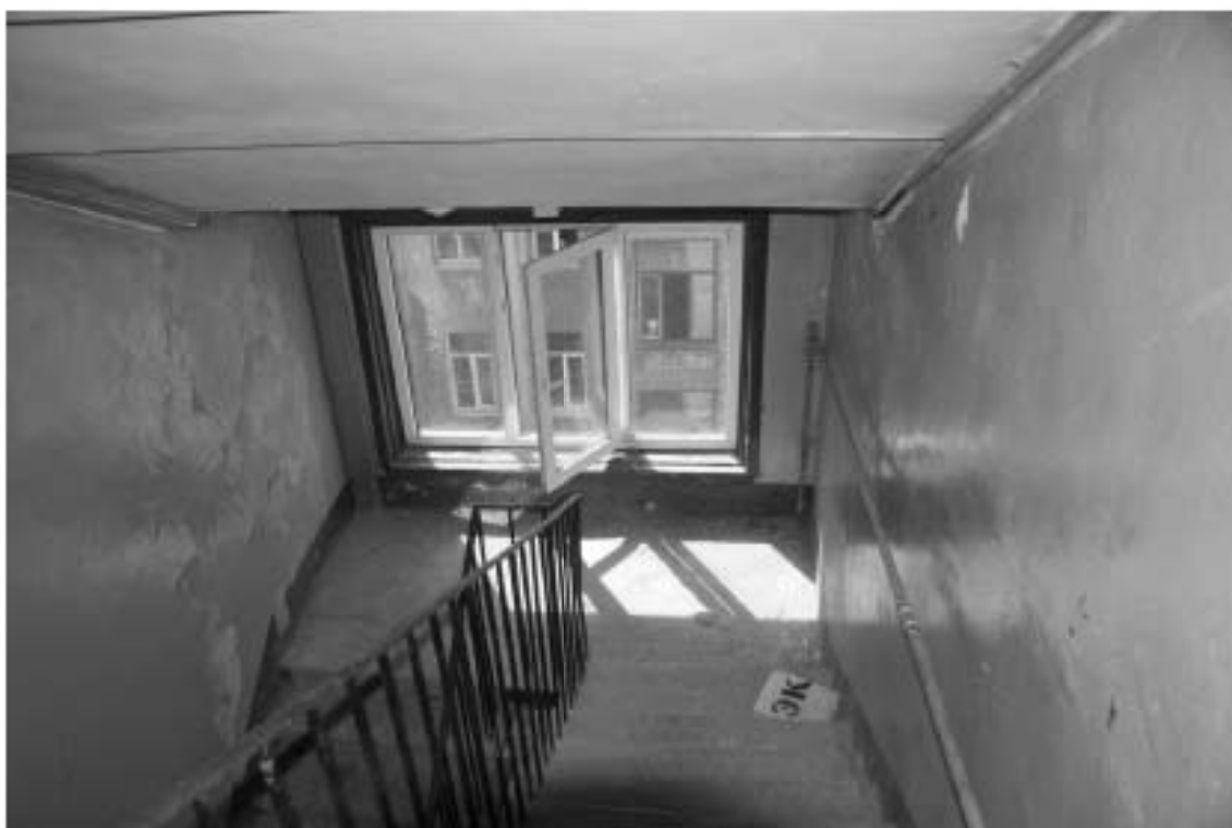
Фото 381. Лестница № 8: Площадка между 7-м и чердачным этажом. Съемка 19.04.2021 г. Михайловская Г. В.
