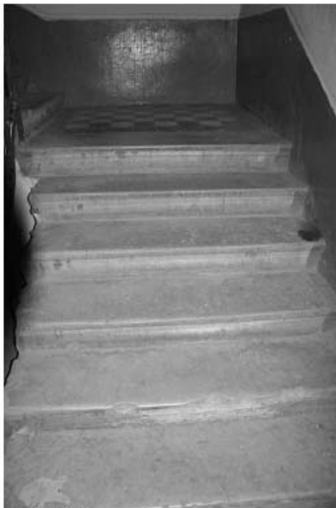
Фото 237. Лестница № 4: Лестничный марш на площадку между 1-м и 2-м этажом. Съемка 19.04.2021 г. Михайловская Г. В.
