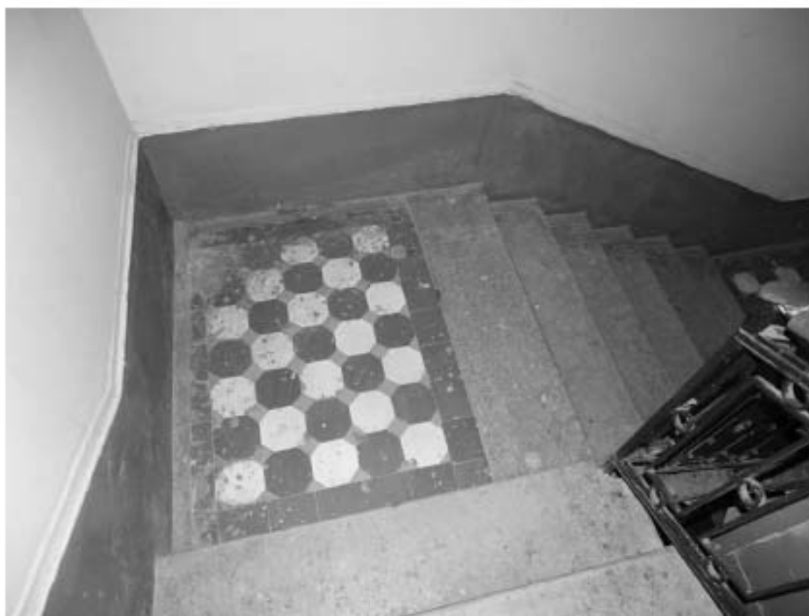
Фото 257. Лестница № 4: Лестничная площадка между 6-м и 7-м этажом. Покрытие пола. Съемка 19.04.2021 г. Михайловская Г. В.
