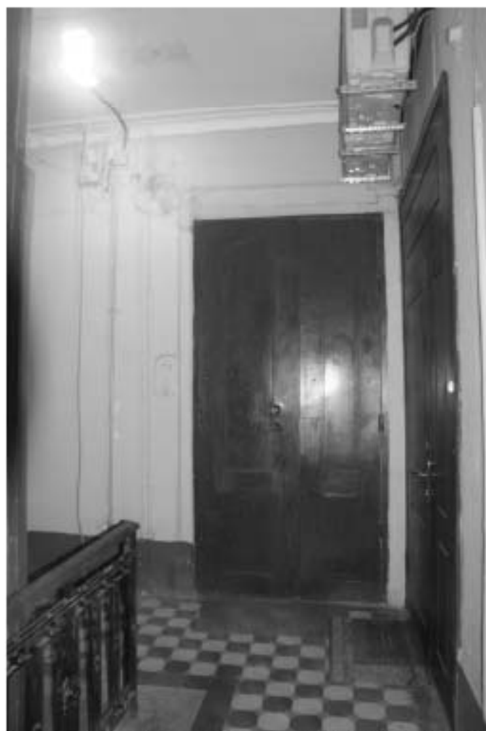
Фото 240. Лестница № 4: 2-й этаж. Съемка 19.04.2021 г. Михайловская Г. В.
