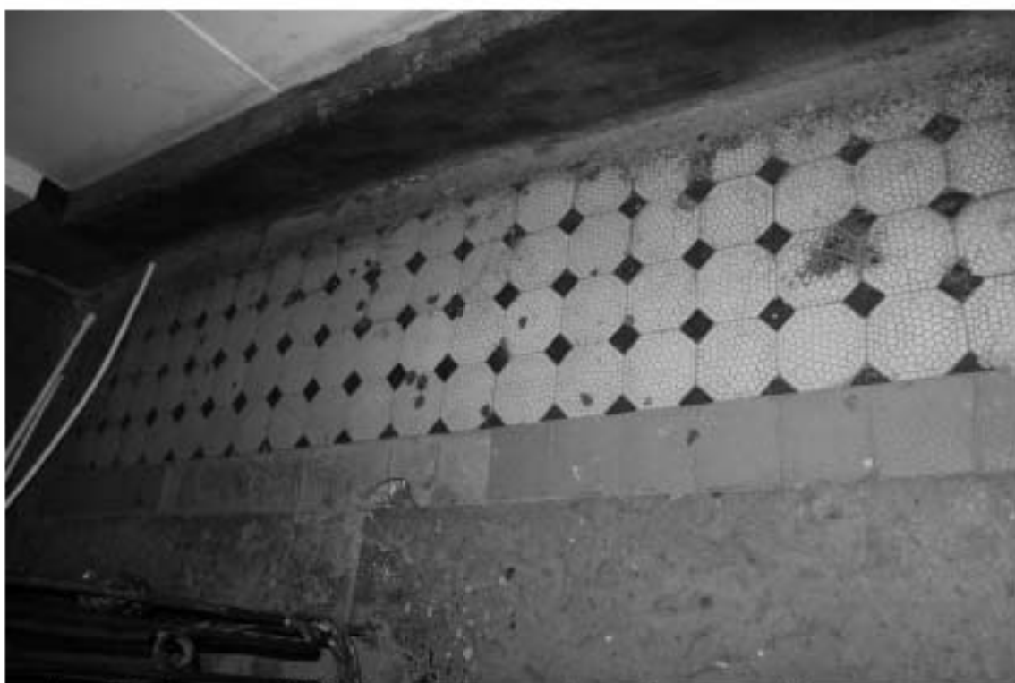
Фото 22. Лестница № 1: Площадка между 2-м и 3-м этажом. Покрытие пола. Съемка 19.04.2021 г. Михайловская Г. В.
