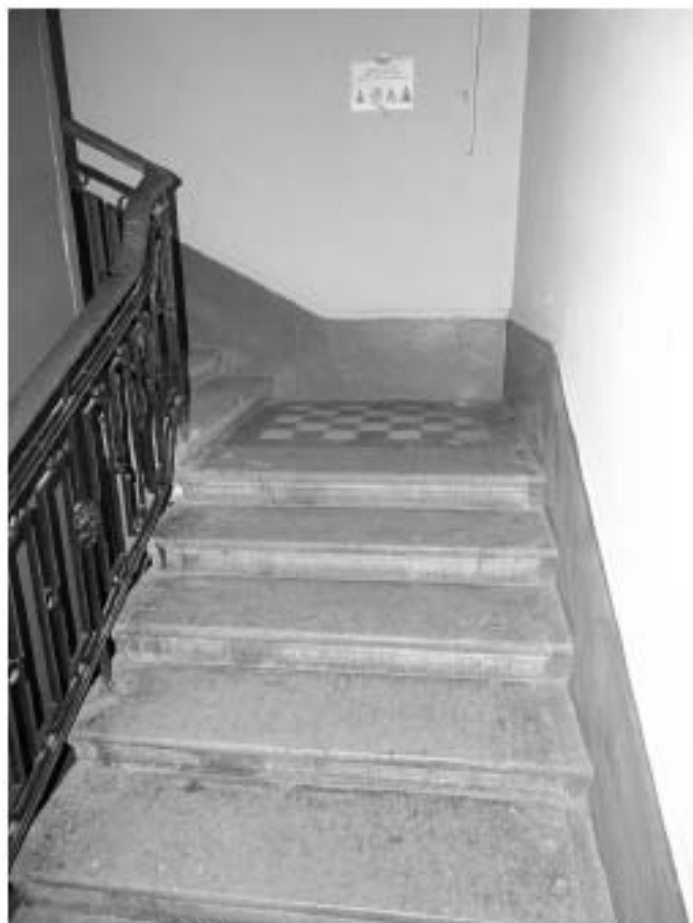
Фото 256. Лестница № 4: Лестничная площадка между 6-м и 7-м этажом. Съемка 19.04.2021 г. Михайловская Г. В.
