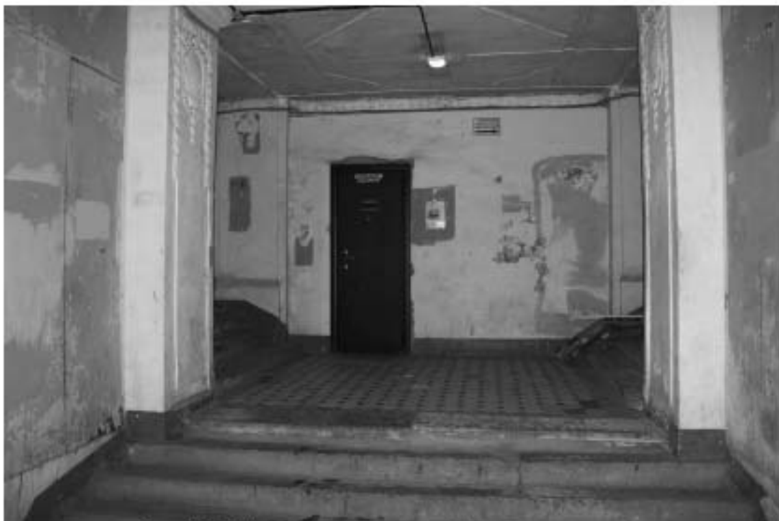
Фото 19. 1-й этаж. Вестибюль по Большому проспекту. Съемка 19.04.2021 г. Михайловская Г. В.
