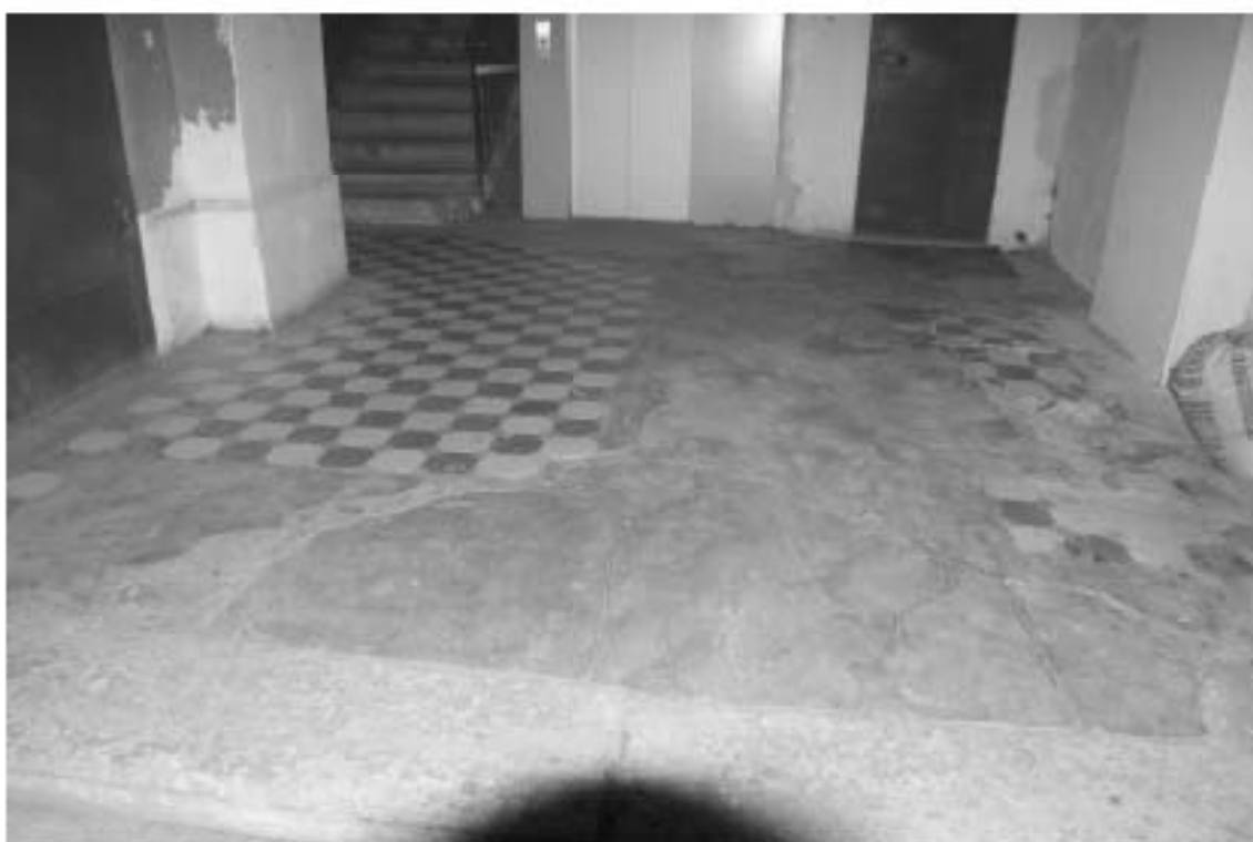
Фото 305. Лестница № 6: 1-й этаж. Вестибюль. Покрытие пола. Съемка 19.04.2021 г. Михайловская Г. В.
