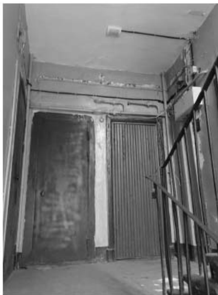
Фото 374. Лестница № 8: 5-й этаж. Съемка 19.04.2021 г. Михайловская Г. В.
