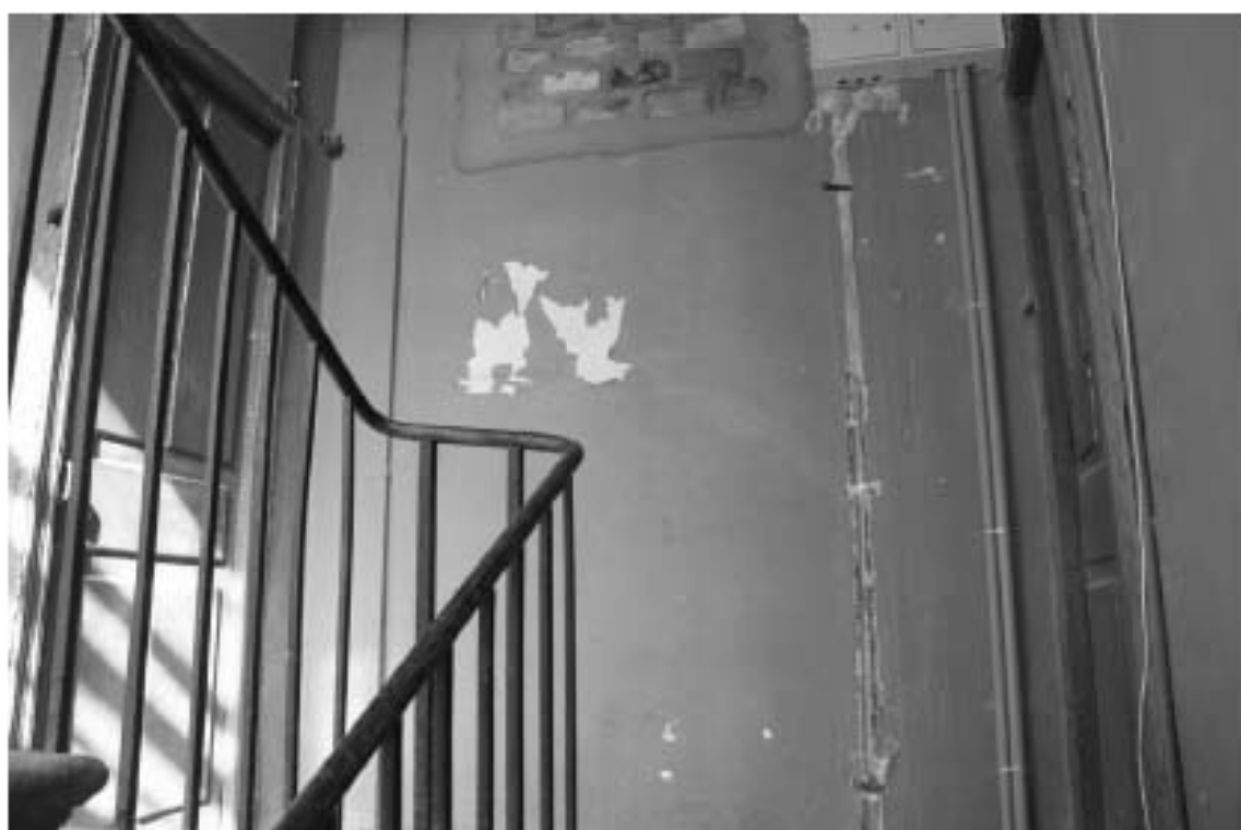
Фото 167. Лестница № 13: Площадка 6-го этажа. Съемка 19.04.2021 г. Михайловская Г. В.
