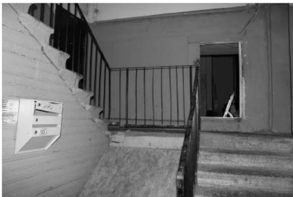
Фото 73. Лестница № 10: Площадка 2-го этажа. Съемка 19.04.2021 г. Михайловская Г. В.
