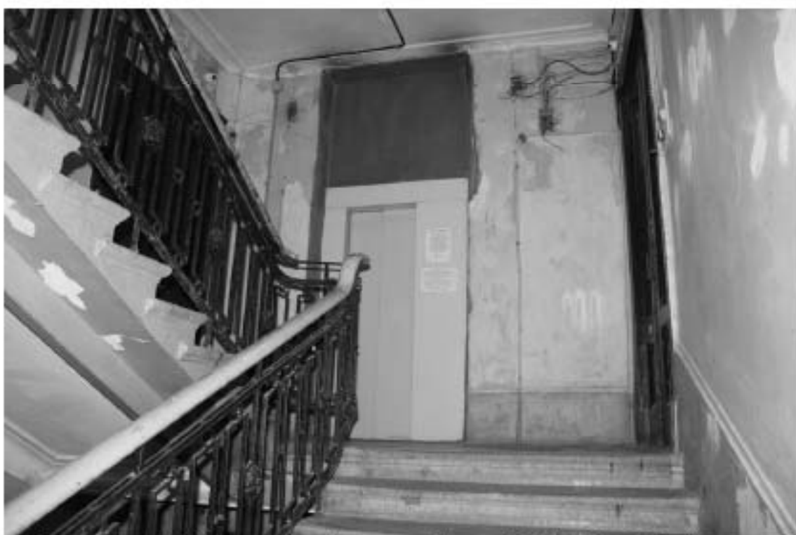
Фото 25. Лестница № 1: Площадка 4-го этажа. Съемка 19.04.2021 г. Михайловская Г. В.
