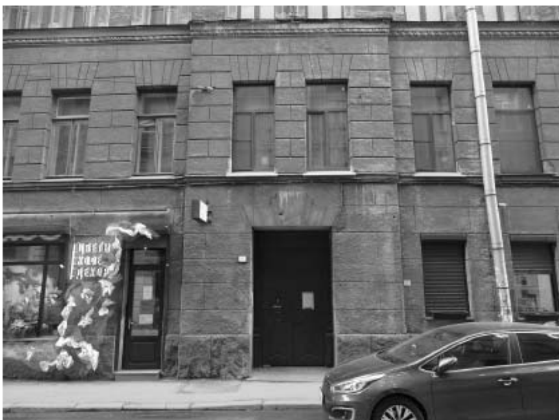
Фото 14. Здание по адресу: г. Санкт-Петербург, Большой проспект П.С., дом 74, литера А. Лицевой фасад по Бармалеевой ул. Вход в парадную, расположенную в центральной части фасада. Съемка 19.04.2021 г. Михайловская Г. В.
