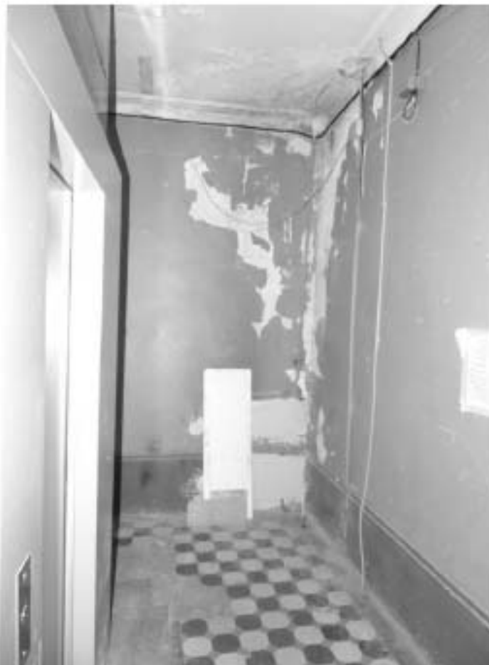
Фото 323. Лестница № 6: 4-й этаж. Съемка 19.04.2021 г. Михайловская Г. В.
