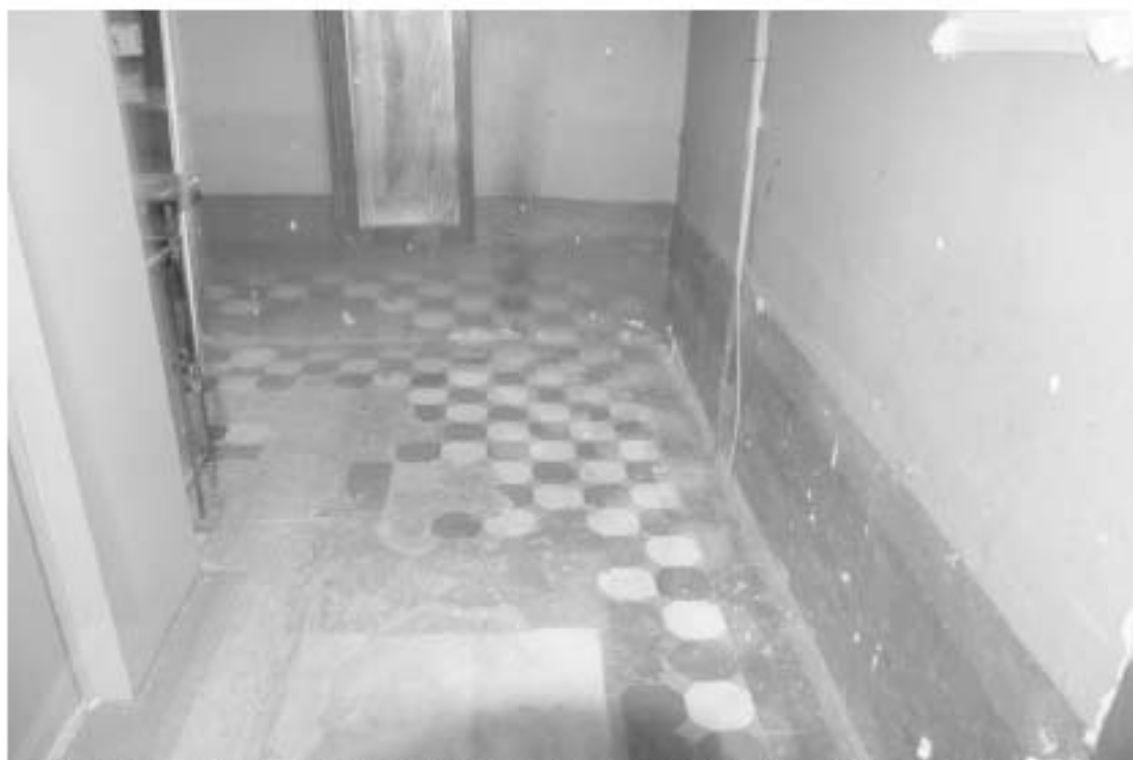
Фото 309. Лестница № 6: 2-й этаж. Съемка 19.04.2021 г. Михайловская Г. В.
