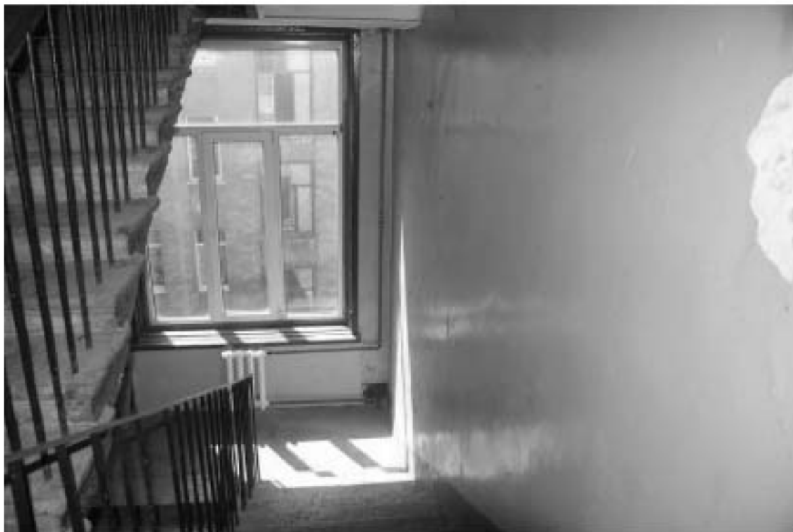
Фото 376. Лестница № 8: Площадка между 5-м и 6-м этажом. Съёмка 19.04.2021 г. Михайловская Г. В.
