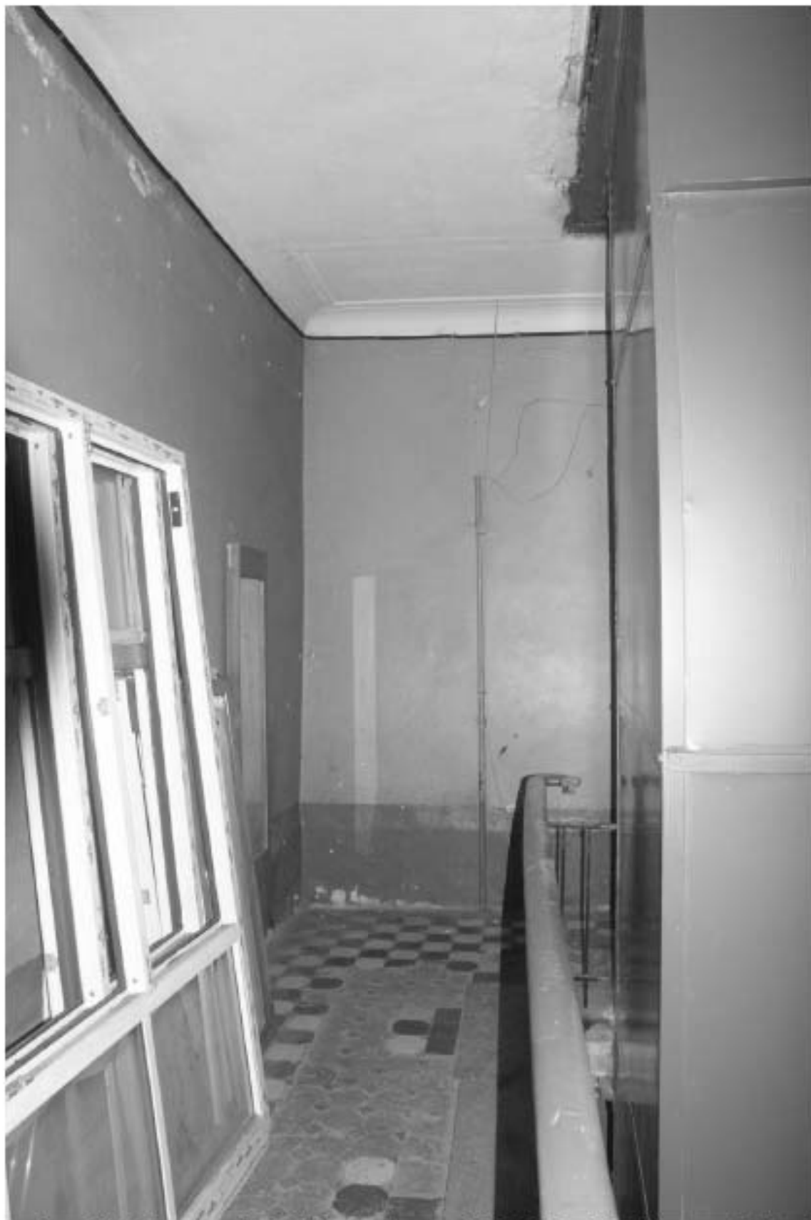
Фото 312. Лестница № 6: 2-й этаж. Съемка 19.04.2021 г. Михайловская Г. В.
