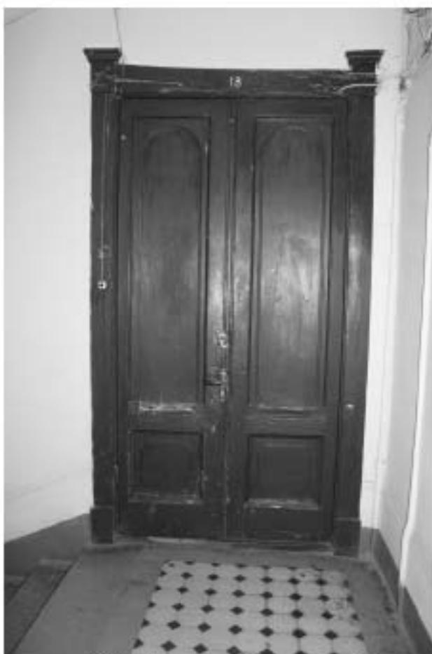
Фото 59. Лестница № 2: Площадка 5-го этажа. Оформление двери. Съемка 19.04.2021 г. Михайловская Г. В.
