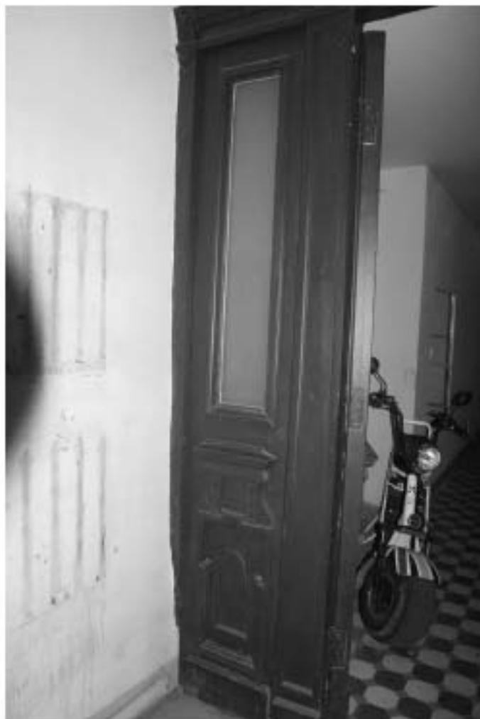
Фото 232. Лестница № 4: 1-й этаж. Вестибюль. Заполнение дверного проема. Съемка 19.04.2021 г. Михайловская Г. В.
