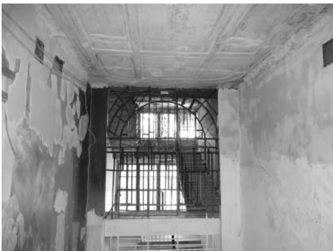
Фото 45. Лестница № 1: Площадка 7-го этажа. Съемка 19.04.2021 г. Михайловская Г. В.
