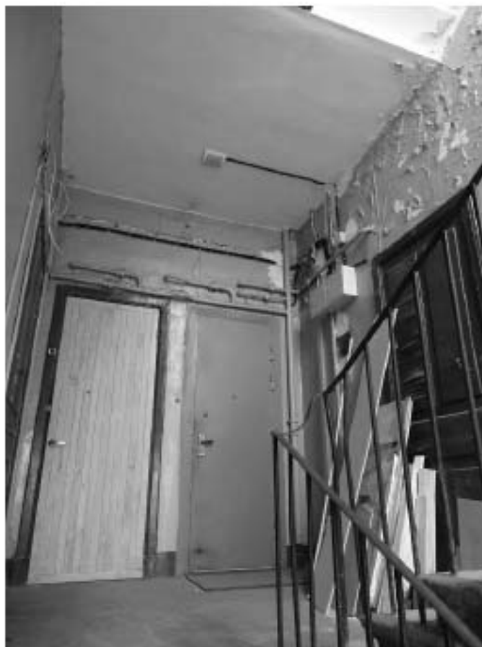
Фото 369. Лестница № 8: 3-й этаж. Съемка 19.04.2021 г. Михайловская Г. В.
