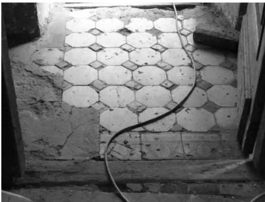
Фото 88. Лестница № 11: 1-й этаж. Тамбур. Покрытие пола. Съемка 19.04.2021 г. Михайловская Г. В.
