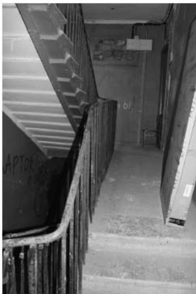
Фото 162. Лестница № 13: Площадка 4-го этажа. Съемка 19.04.2021 г. Михайловская Г. В.
