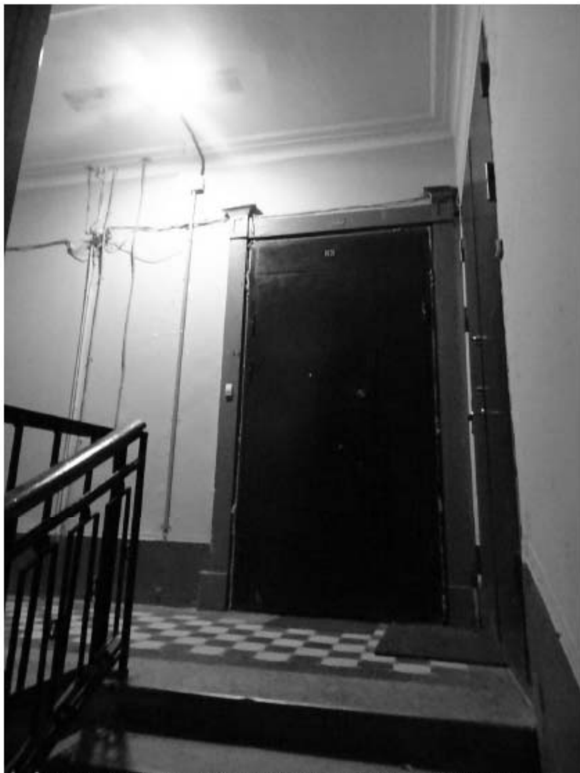
Фото 244. Лестница № 4: 4-й этаж. Съёмка 19.04.2021 г. Михайловская Г. В.
