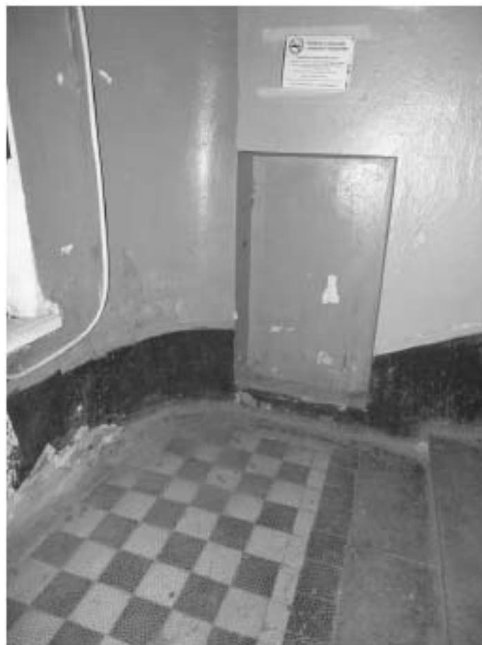
Фото 286. Лестница № 5: Площадка между 3-м и 4-м этажом. Ниша в стене. Съемка 19.04.2021 г. Михайловская Г. В.
