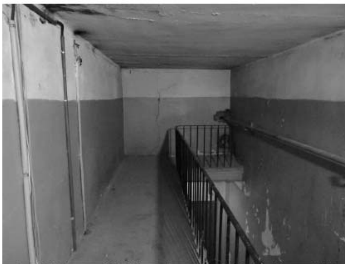
Фото 356. Лестница № 7: 8-й этаж. Съёмка 19.04.2021 г. Михайловская Г. В.
