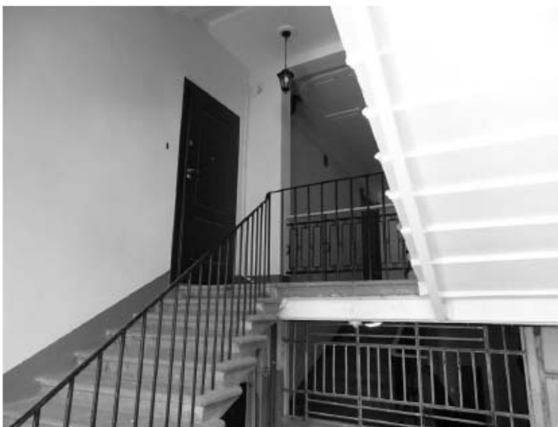
Фото 111. Лестница № 11: Вид на площадку 7-го этажа. Съемка 19.04.2021 г. Михайловская Г. В.
