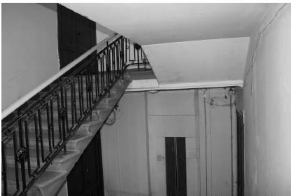
Фото 63. Лестница № 2: 6-й этаж. Съемка 19.04.2021 г. Михайловская Г. В.
