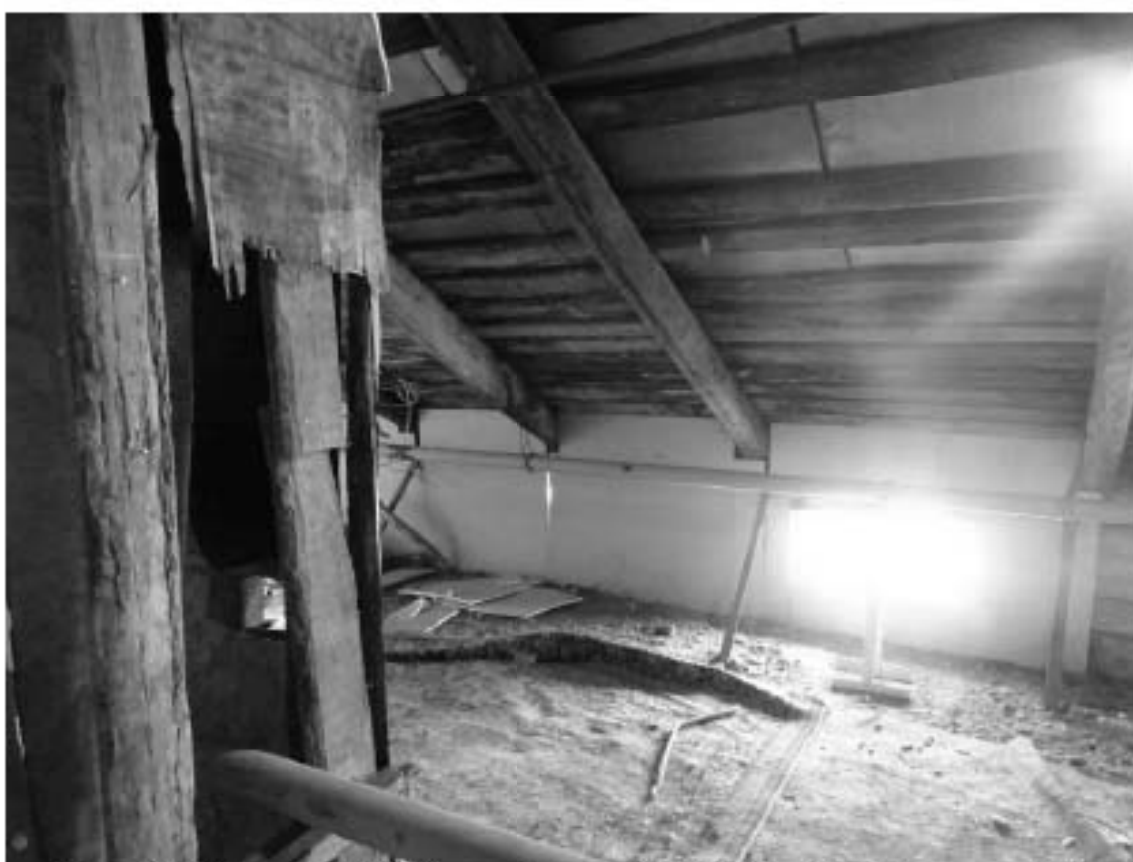
Фото 358. Лестница № 7: Чердак. Съёмка 19.04.2021 г. Михайловская Г. В.
