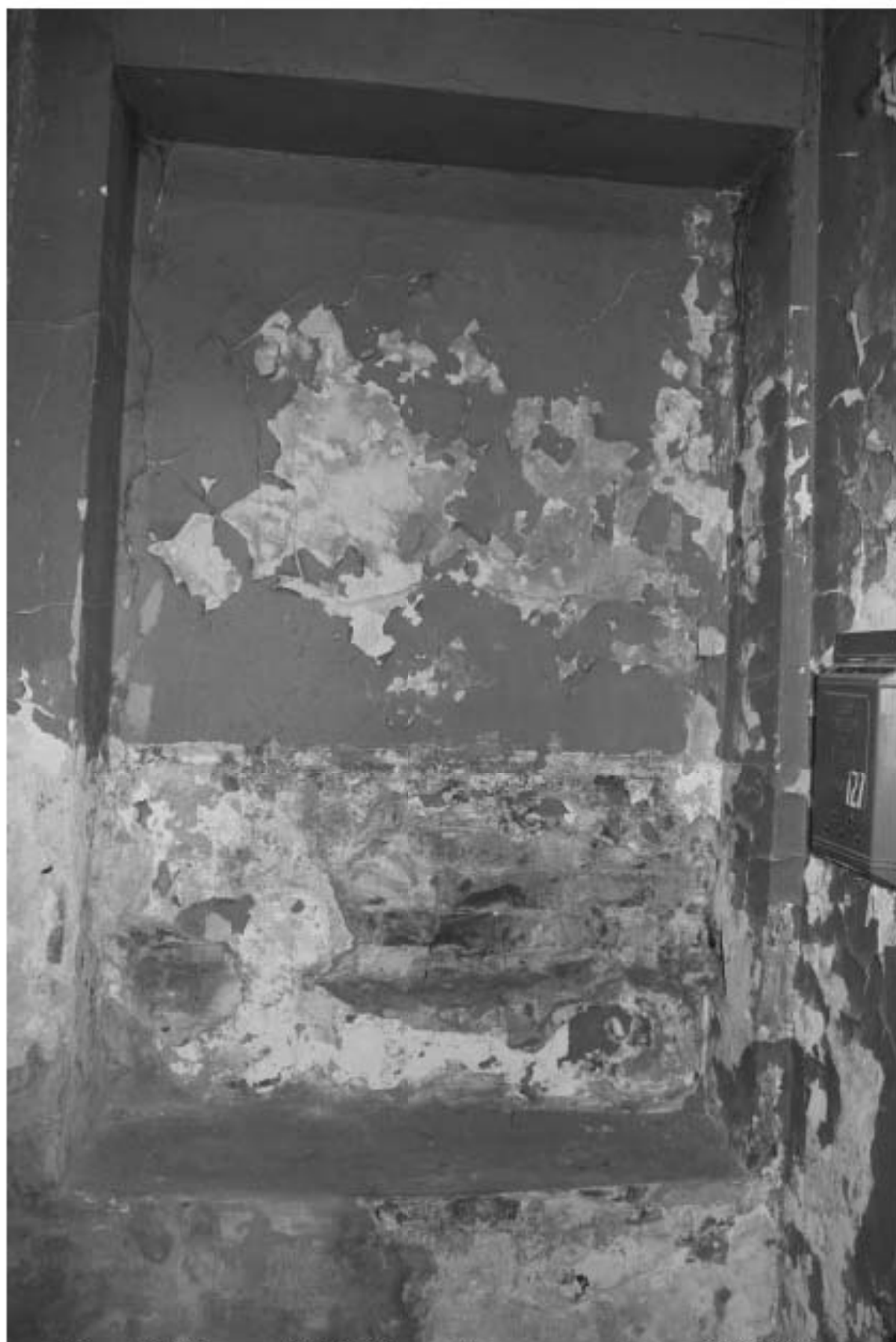
Фото 149. Лестница № 13: 1-й этаж. Ниша в стене. Съемка 19.04.2021 г. Михайловская Г. В.
