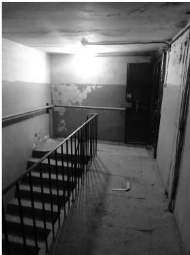
Фото 355. Лестница № 7: 8-й этаж. Съёмка 19.04.2021 г. Михайловская Г. В.
