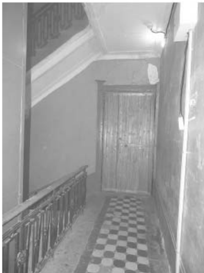
Фото 313. Лестница № 6: 2-й этаж. Съемка 19.04.2021 г. Михайловская Г. В.
