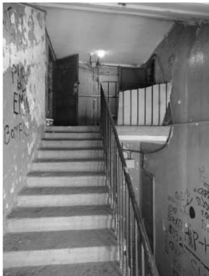
Фото 405. Лестница № 9: Чердачный этаж. Съемка 19.04.2021 г. Михайловская Г. В.
