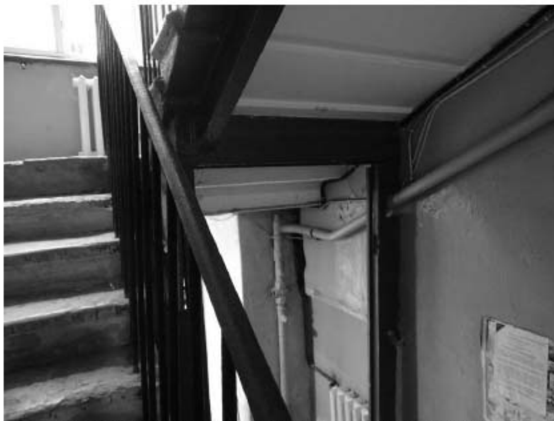
Фото 360. Лестница № 8: 1-й этаж. Входной тамбур. Съемка 19.04.2021 г. Михайловская Г. В.
