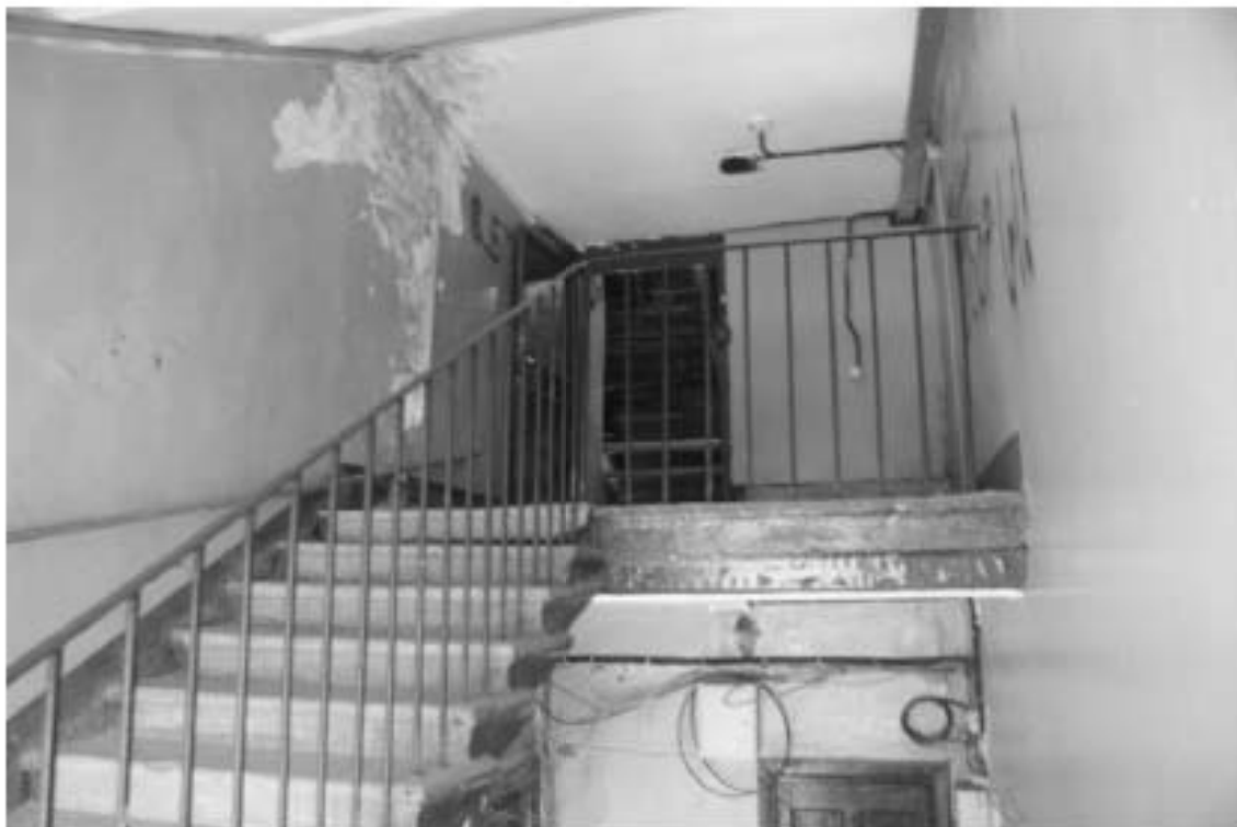
Фото 382. Лестница № 8: Чердачный этаж. Съемка 19.04.2021 г. Михайловская Г. В.
