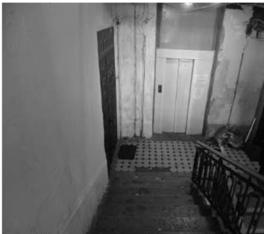
Фото 36. Лестница № 1: Площадка 6-го этажа. Съемка 19.04.2021 г. Михайловская Г. В.
