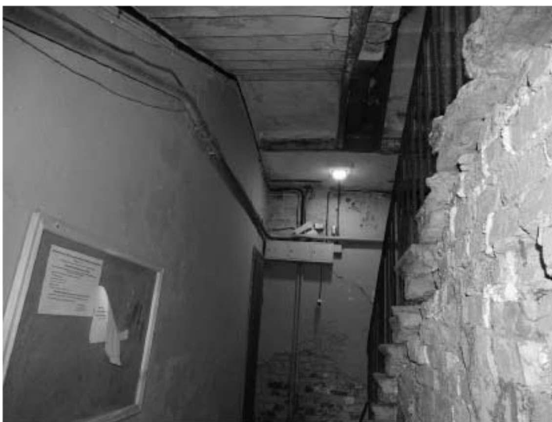
Фото 122. Лестница № 12: 1-й этаж. Съемка 19.04.2021 г. Михайловская Г. В.
