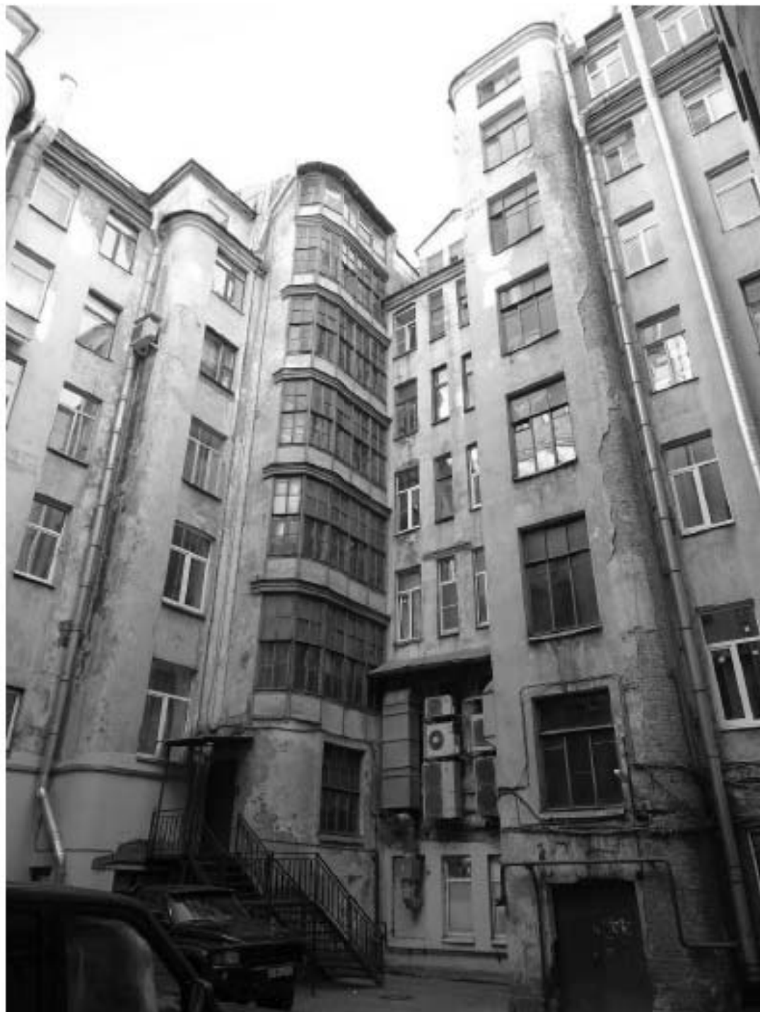
Фото 38. Здание по адресу: г. Санкт-Петербург, Большой проспект П.С., дом 74, литера А. Восточный внутренний двор. Съемка 19.04.2021 г. Михайловская Г. В.
