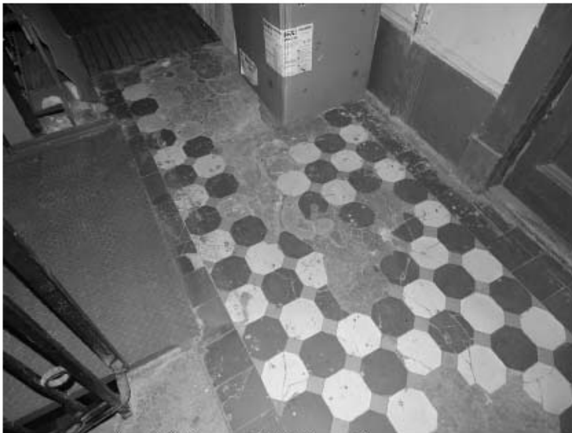
Фото 260. Лестница № 4: 7-й этаж. Покрытие пола. Съемка 19.04.2021 г. Михайловская Г. В.
