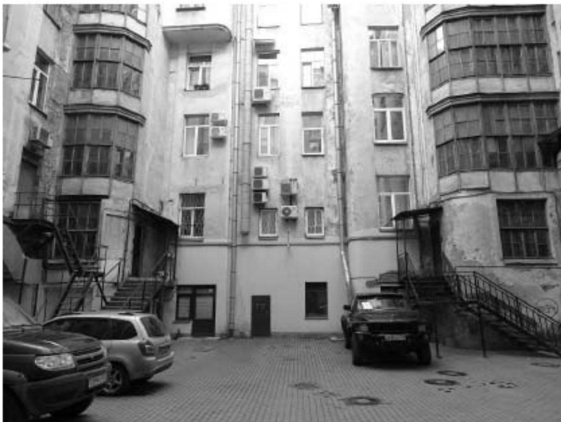
Фото 36. Здание по адресу: г. Санкт-Петербург, Большой проспект П.С., дом 74, литера А. Восточный внутренний двор. Съемка 19.04.2021 г. Михайловская Г. В.
