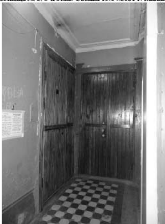
Фото 326. Лестница № 6: 5-й этаж. Съемка 19.04.2021 г. Михайловская Г. В.
