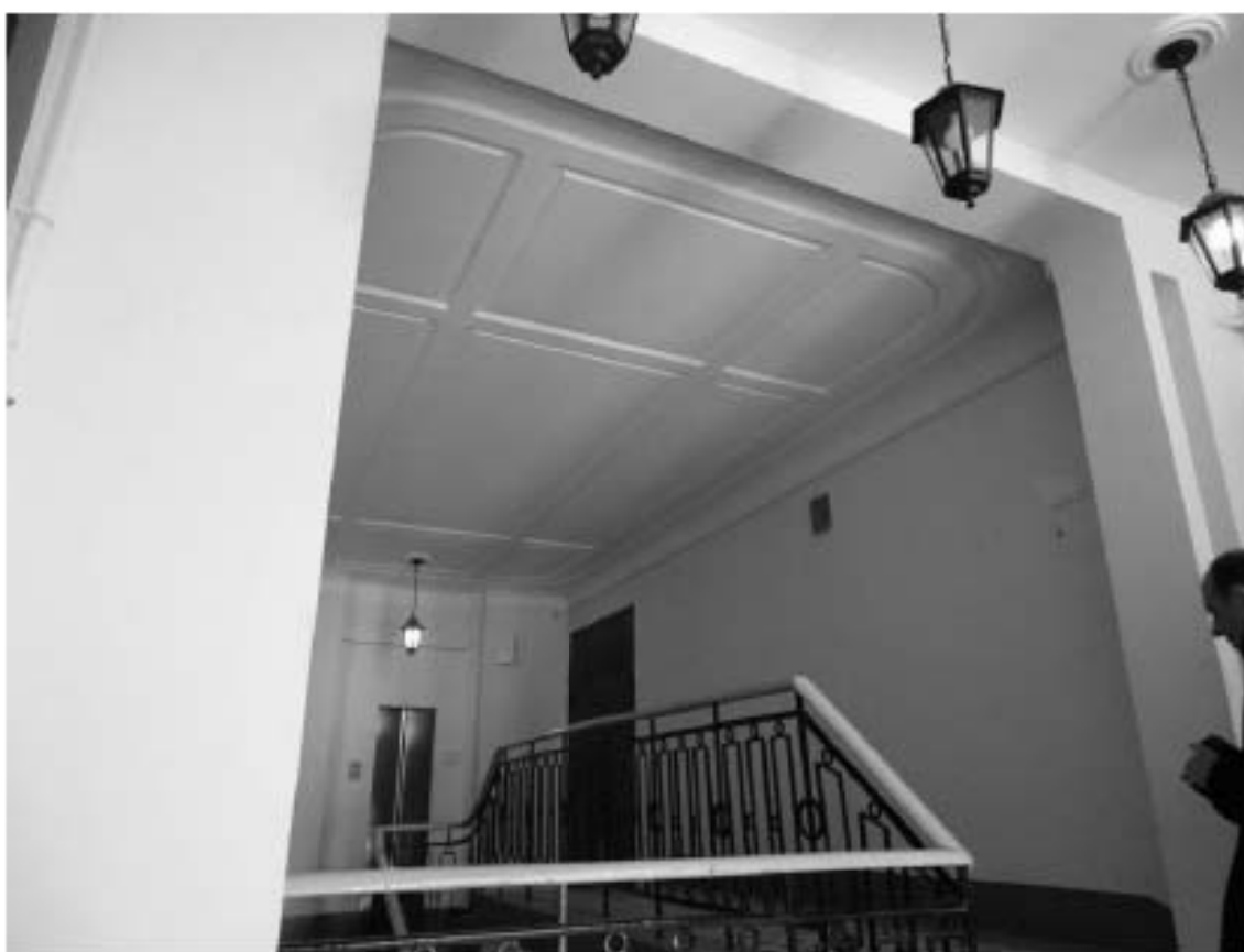
Фото 113. Лестница № 11: Площадка 7-го этажа. Переход между лестницами. Съемка 19.04.2021 г. Михайловская Г. В.
