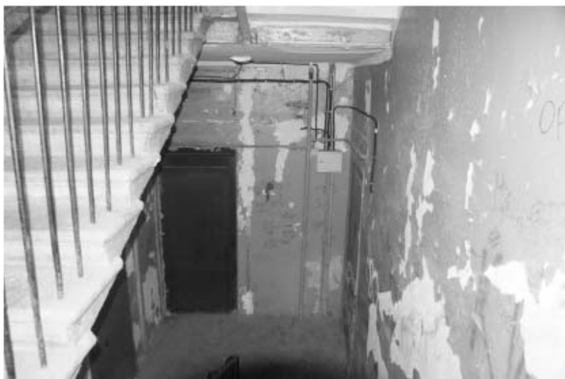
Фото 387. Лестница № 9: 2-й этаж. Съемка 19.04.2021 г. Михайловская Г. В.
