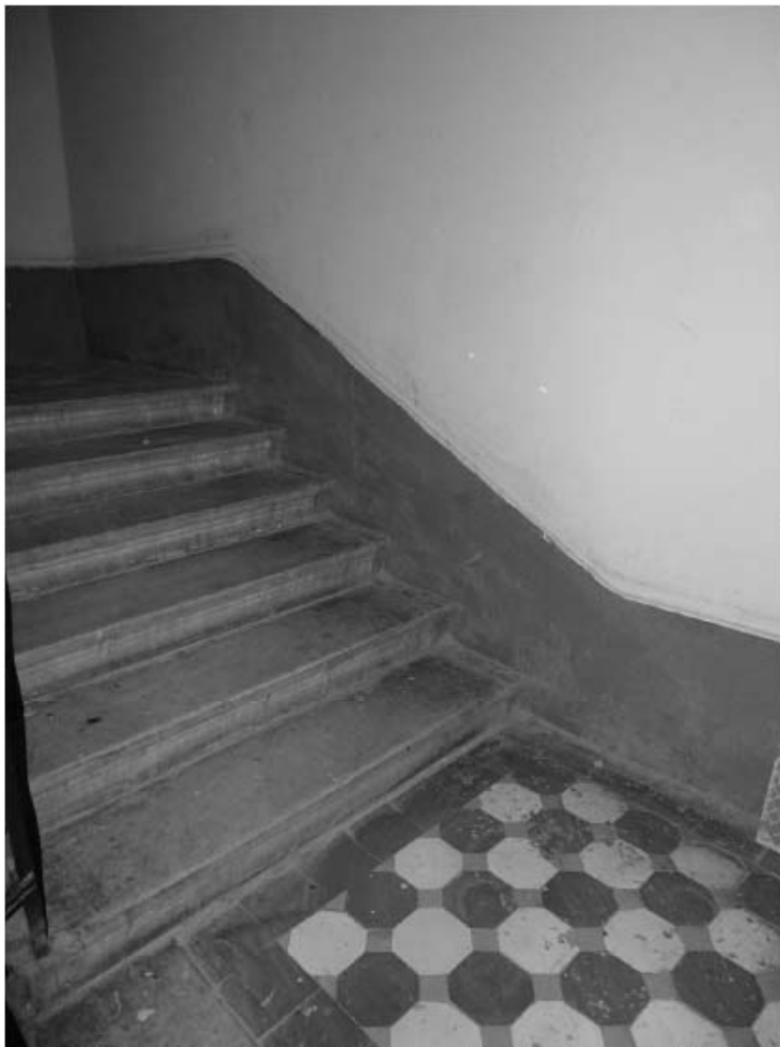
Фото 247. Лестница № 4: Лестничная площадка между 4-м и 5-м этажом. Съемка 19.04.2021 г. Михайловская Г. В.
