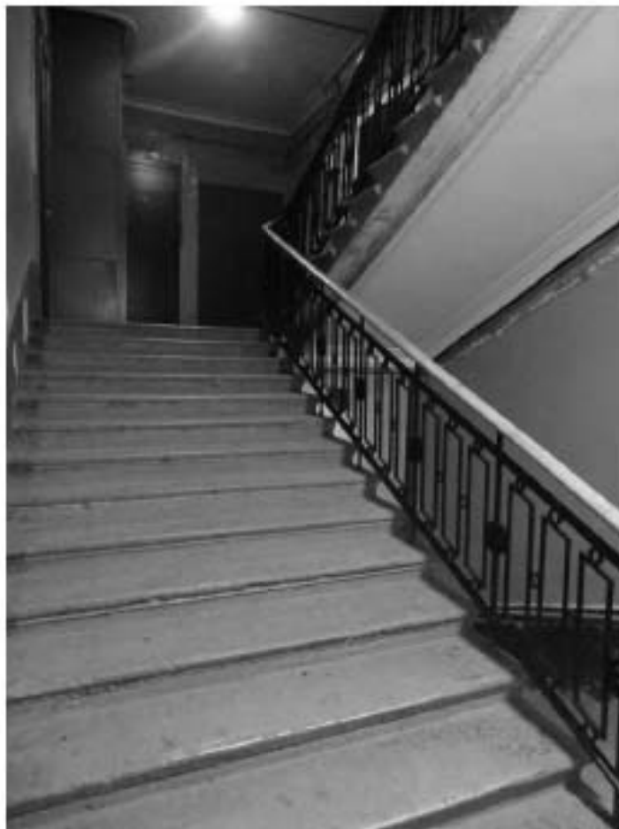
Фото 276. Лестница № 5: Лестничный марш на 2-й этаж. Съемка 19.04.2021 г. Михайловская Г. В.
