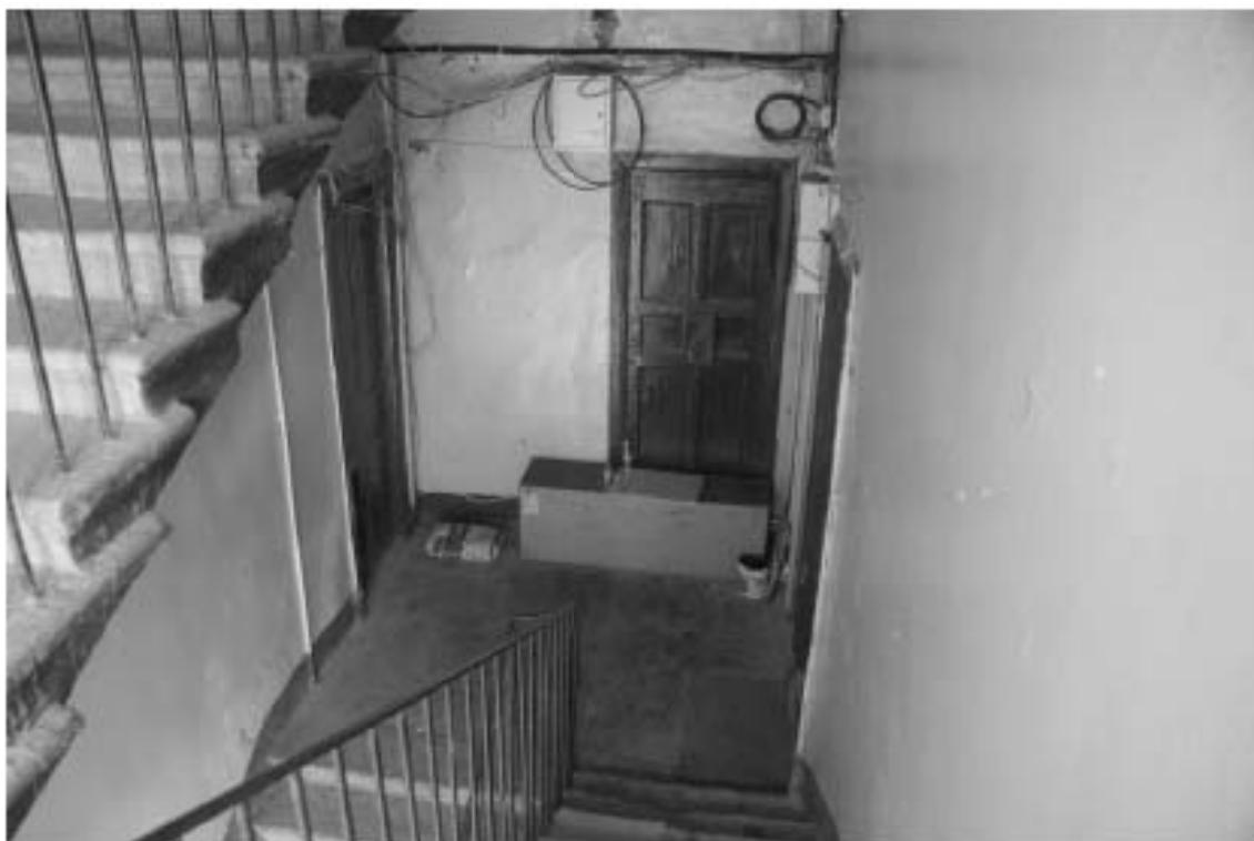
Фото 380. Лестница № 8: 7-й этаж. Съемка 19.04.2021 г. Михайловская Г. В.
