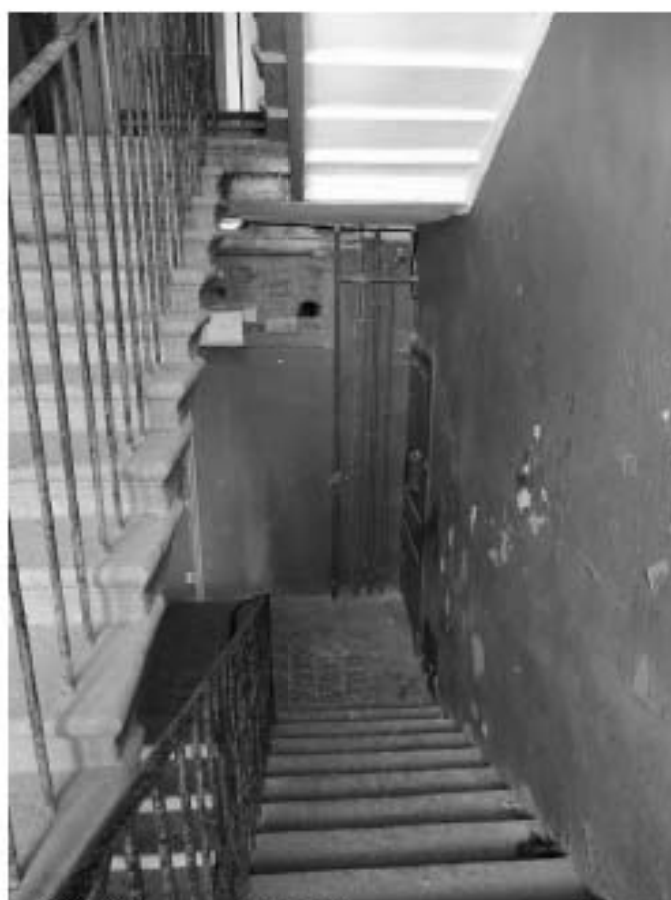
Фото 137. Лестница № 12: Вид на площадку 6-го этажа. Съемка 19.04.2021 г. Михайловская Г. В.
