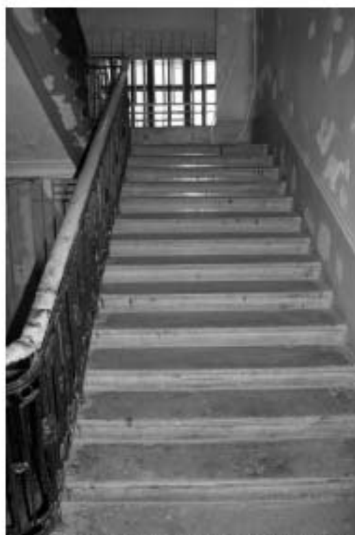
Фото 28. Лестница № 1: Лестничный марш на площадку между 4-м и 5-м этажом. Съемка 19.04.2021 г. Михайловская Г. В.
