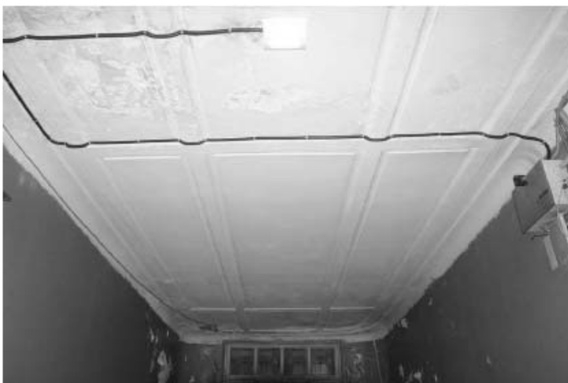
Фото 297. Лестница № 5: 7-й этаж. Оформление потолка. Съемка 19.04.2021 г. Михайловская Г. В.
