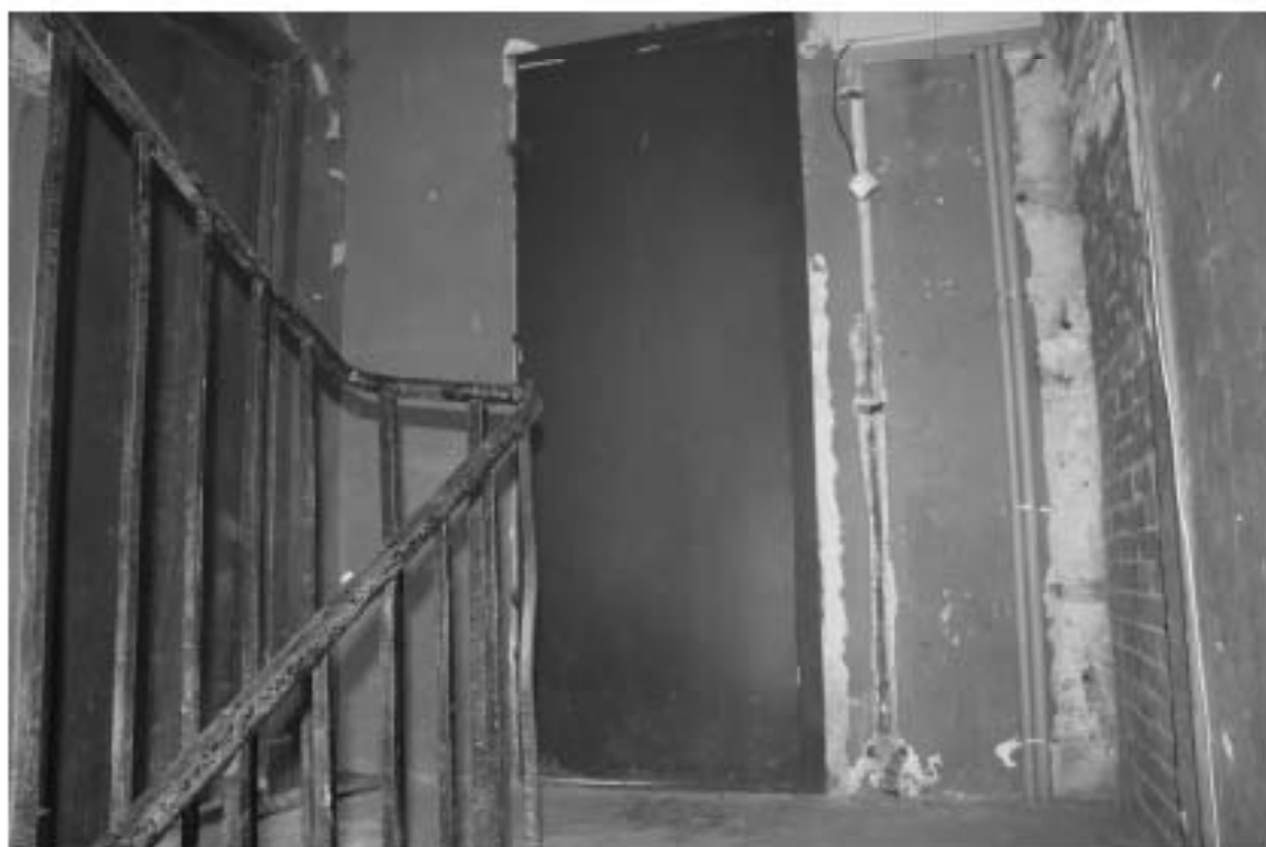
Фото 170. Лестница № 13: Площадка 7-го этажа. Съемка 19.04.2021 г. Михайловская Г. В.
