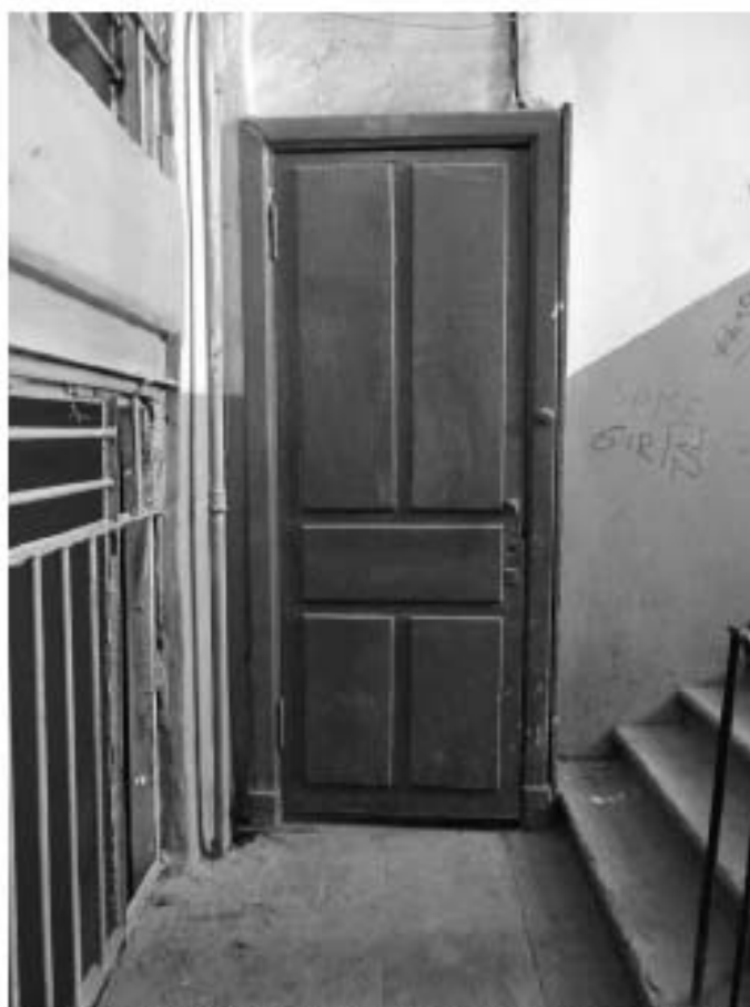
Фото 106. Лестница № 11: Площадка 5-го этажа. Оформление двери. Съемка 19.04.2021 г. Михайловская Г. В.
