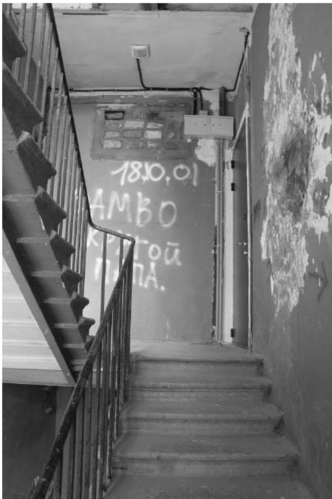
Фото 164. Лестница № 13: Площадка 5-го этажа. Съемка 19.04.2021 г. Михайловская Г. В.
