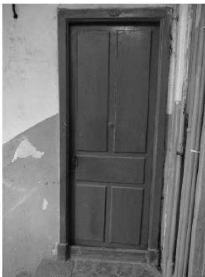
Фото 105. Лестница № 11: Площадка 5-го этажа. Оформление двери. Съемка 19.04.2021 г. Михайловская Г. В.
