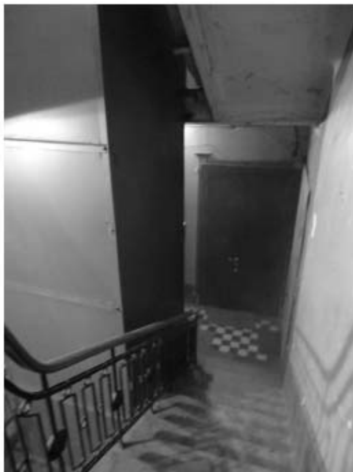
Фото 319. Лестница № 6: 3-й этаж. Съёмка 19.04.2021 г. Михайловская Г. В.
