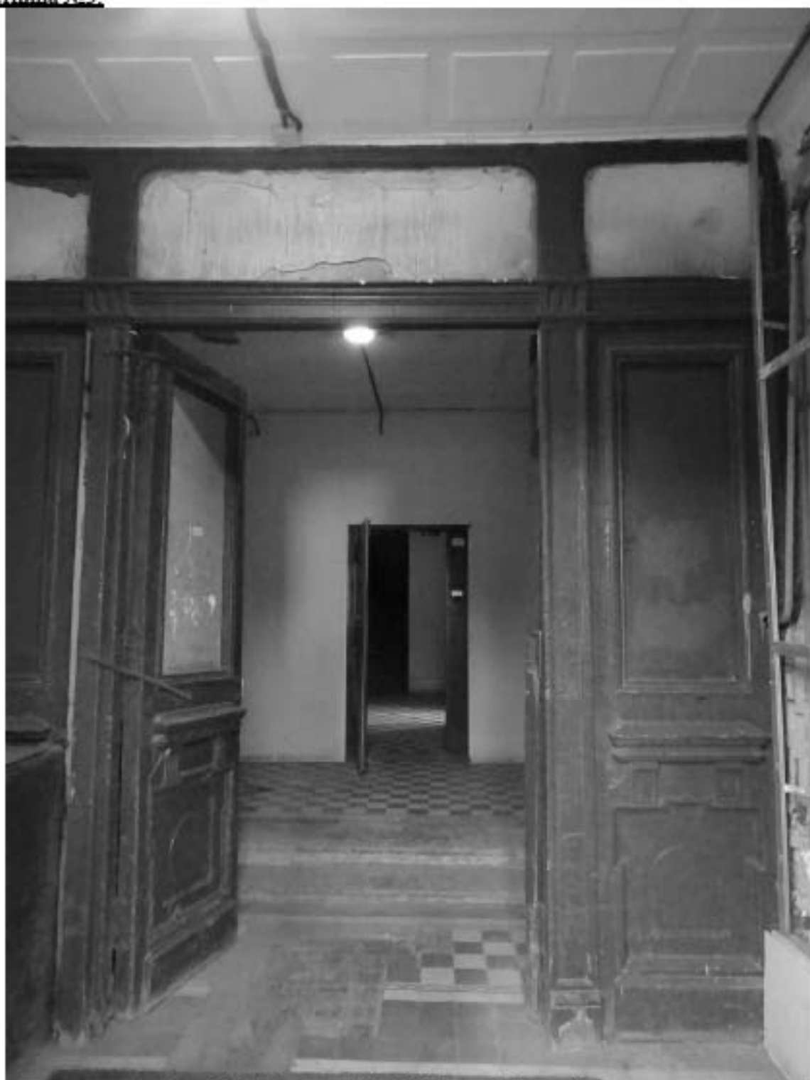
Фото 262. Лестница № 5: 1-й этаж. Входной тамбур. Съемка 19.04.2021 г. Михайловская Г. В.
