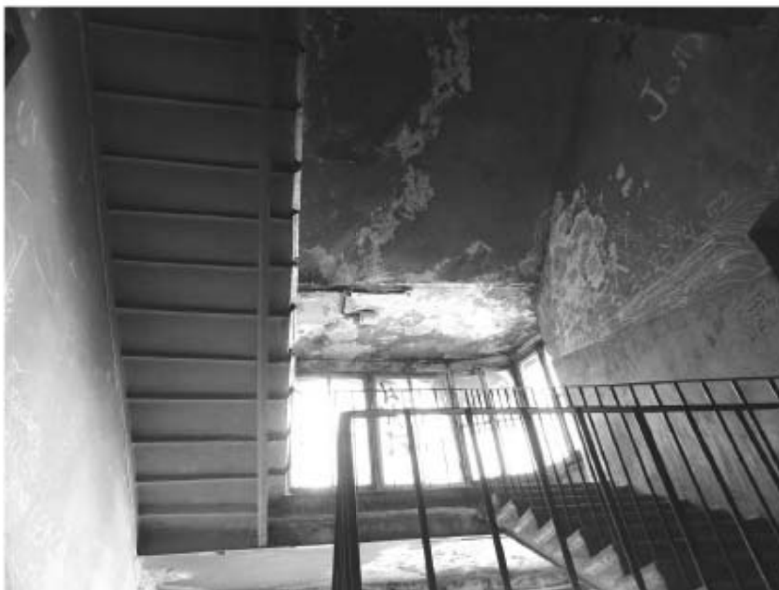
Фото 85. Лестница № 10: Площадка между 7-м и чердачным этажом. Съемка 19.04.2021 г. Михайловская Г. В.
