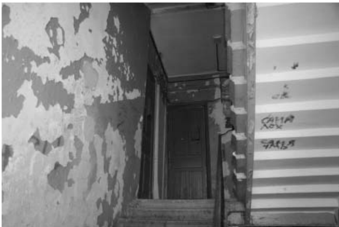
Фото 396. Лестница № 9: 5-й этаж. Съемка 19.04.2021 г. Михайловская Г. В.
