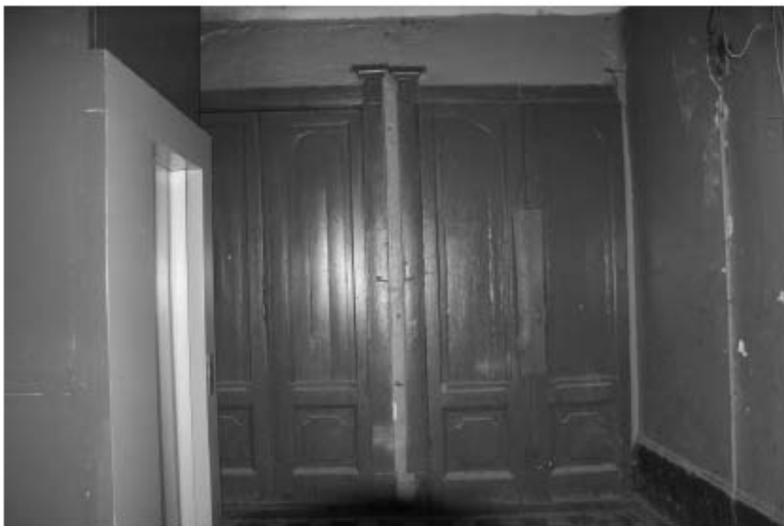
Фото 296. Лестница № 5: 7-й этаж. Съемка 19.04.2021 г. Михайловская Г. В.
