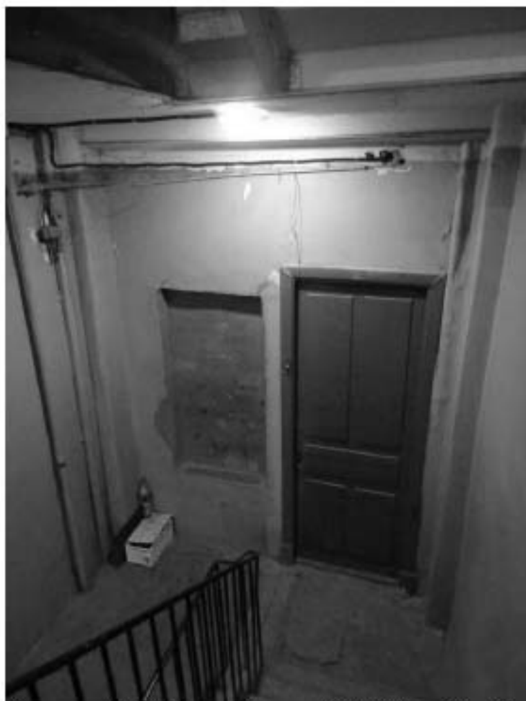
Фото 347. Лестница № 7: 5-й этаж. Съёмка 19.04.2021 г. Михайловская Г. В.
