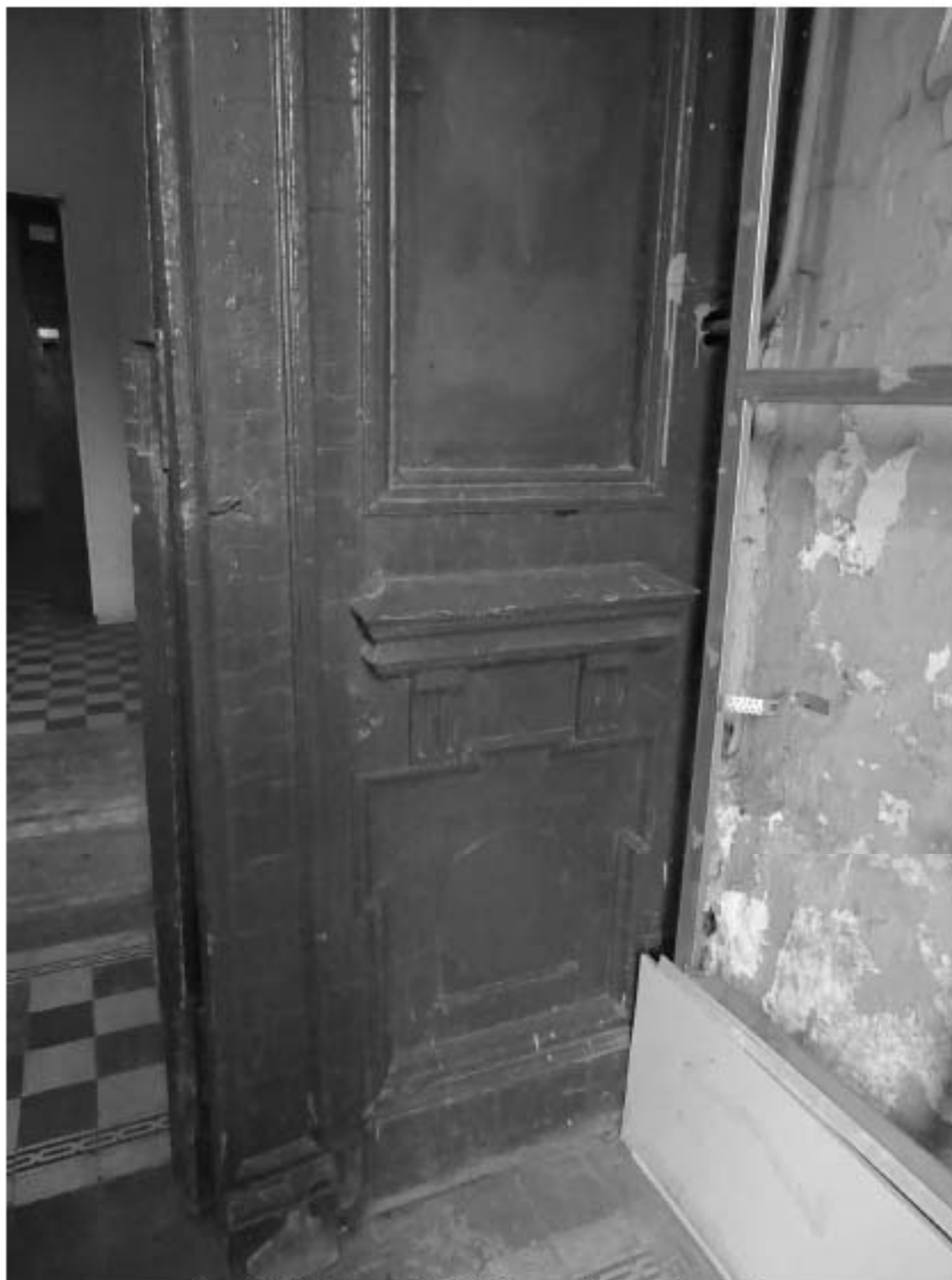
Фото 267. Лестница № 5: 1-й этаж. Входной тамбур. Съемка 19.04.2021 г. Михайловская Г. В.
