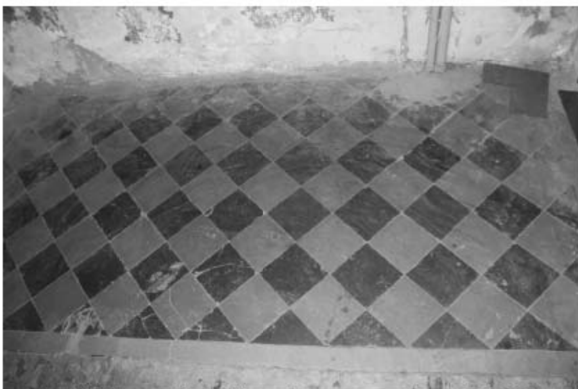
Фото 148. Лестница № 13: 1-й этаж. Покрытие пола. Съемка 19.04.2021 г. Михайловская Г. В.
