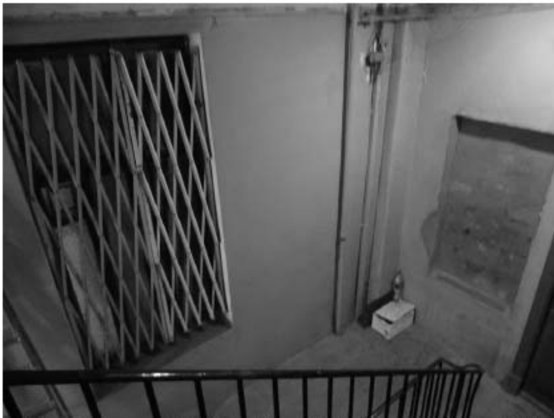
Фото 346. Лестница № 7: 5-й этаж. Съёмка 19.04.2021 г. Михайловская Г. В.
