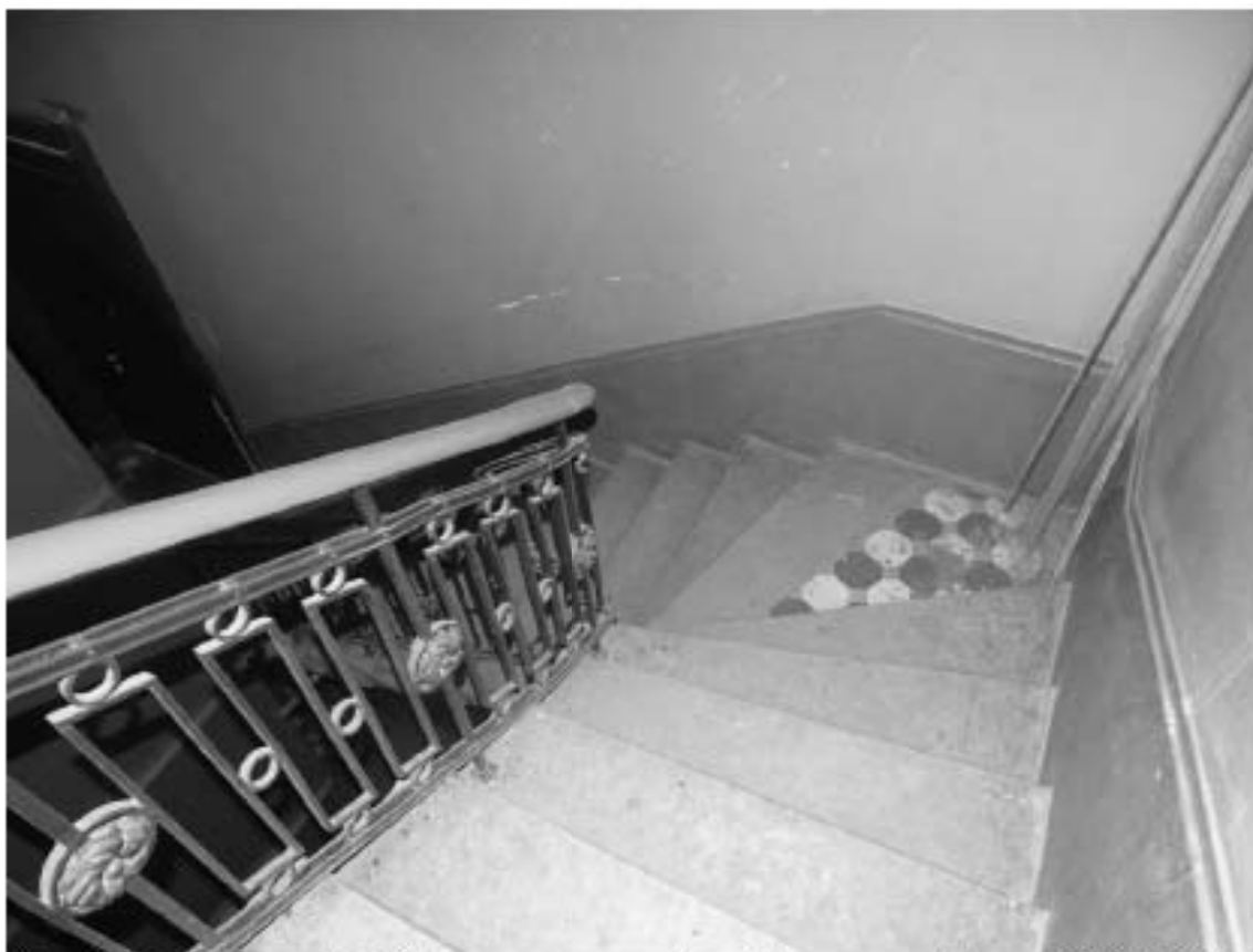
Фото 333. Лестница № 6: Площадка между 6-м и 7-м этажом. Съёмка 19.04.2021 г. Михайловская Г. В.
