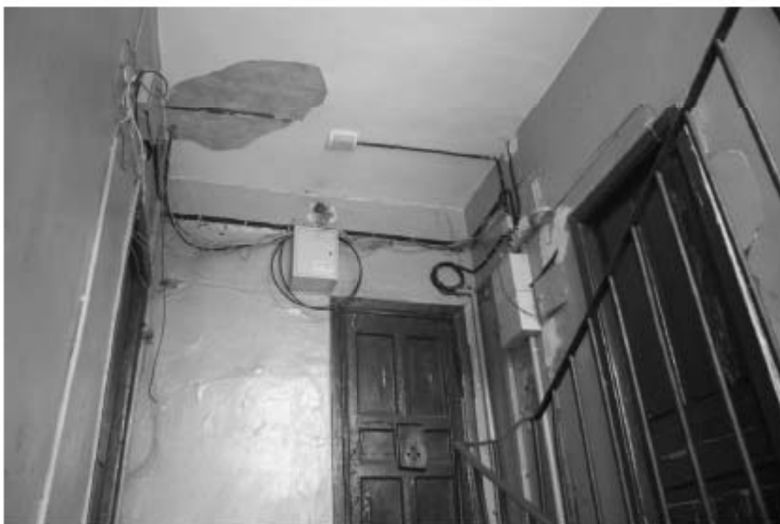
Фото 379. Лестница № 8: 7-й этаж. Съёмка 19.04.2021 г. Михайловская Г. В.
