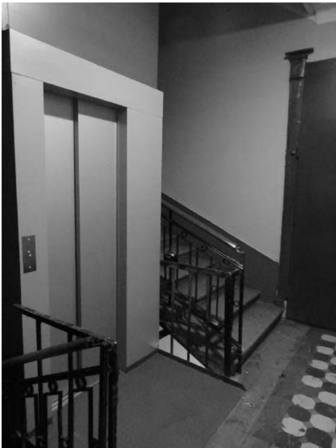
Фото 249. Лестница № 4: 5-й этаж. Съемка 19.04.2021 г. Михайловская Г. В.
