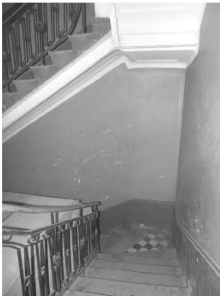
Фото 308. Лестница № 6: Лестничный марш между 1-м и 2-м этажом. Съемка 19.04.2021 г. Михайловская Г. В.
