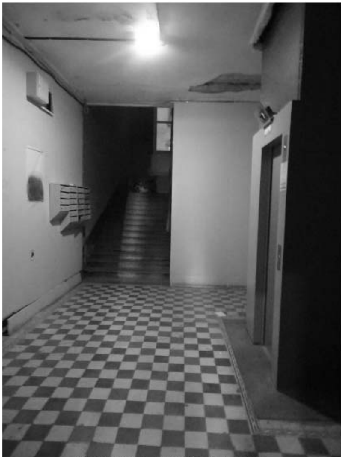
Фото 270. Лестница № 5: 1-й этаж. Вестибюль. Съемка 19.04.2021 г. Михайловская Г. В.
