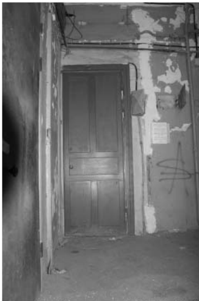
Фото 390. Лестница № 9: 3-й этаж. Съёмка 19.04.2021 г. Михайловская Г. В.
