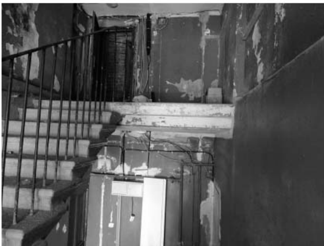
Фото 143. Лестница № 12: Площадка чердачного этажа. Съемка 19.04.2021 г. Михайловская Г. В.
