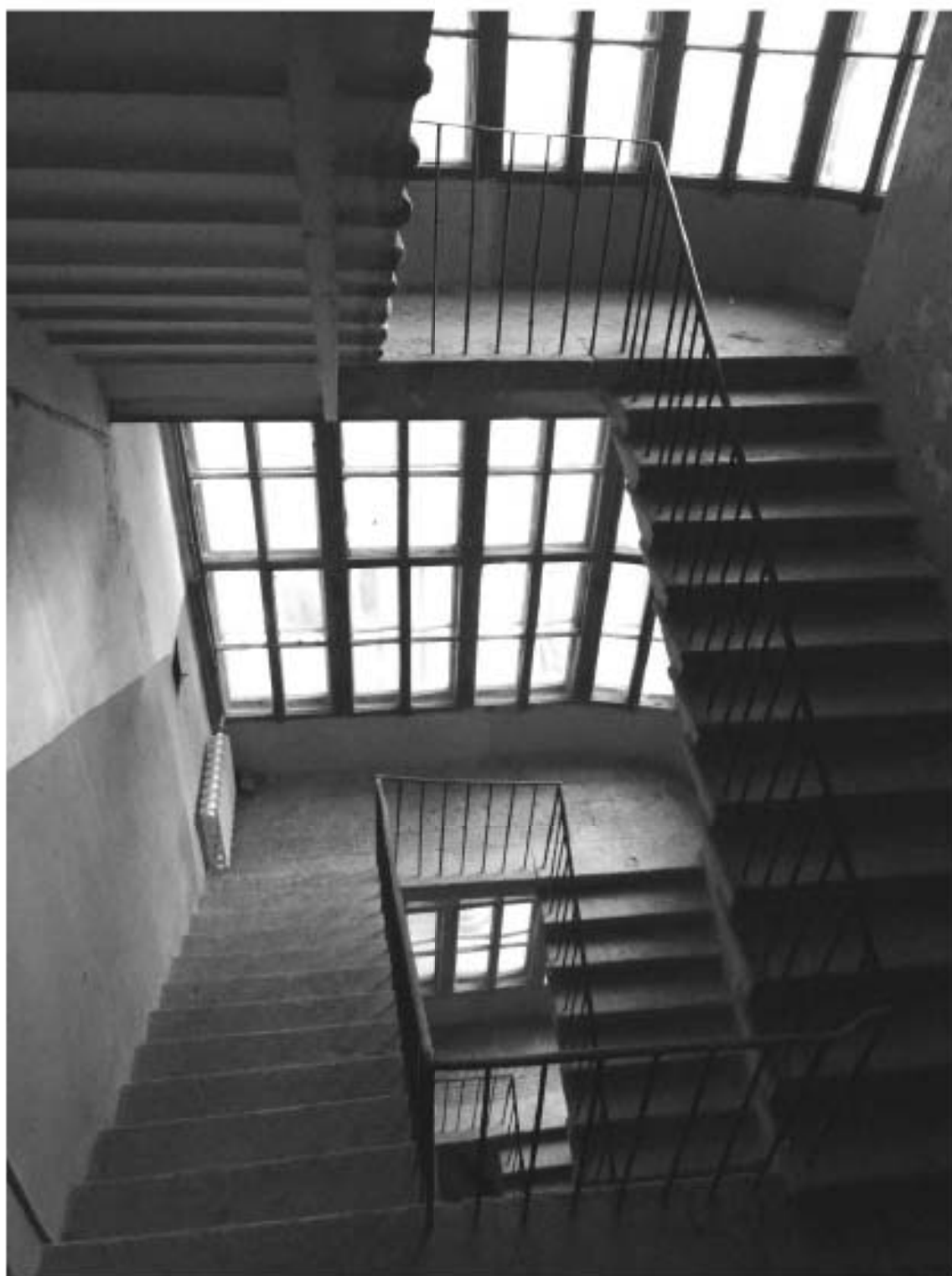
Фото 78. Лестница № 10: Лестничный марш. Вид на площадку между 3-м и 4-м этажом. Съемка 19.04.2021 г. Михайловская Г. В.
