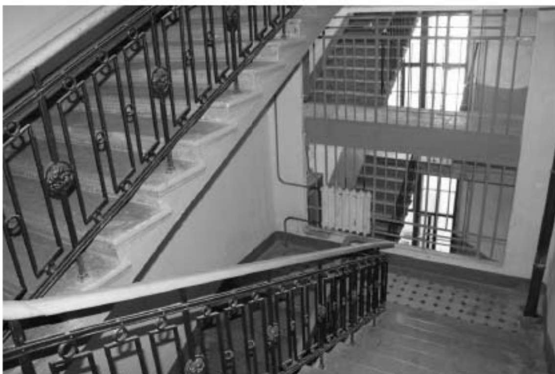
Фото 61. Лестница № 2: Лестничная площадка м/у 5-м и 6-м этажом. Съемка 19.04.2021 г. Михайловская Г. В.
