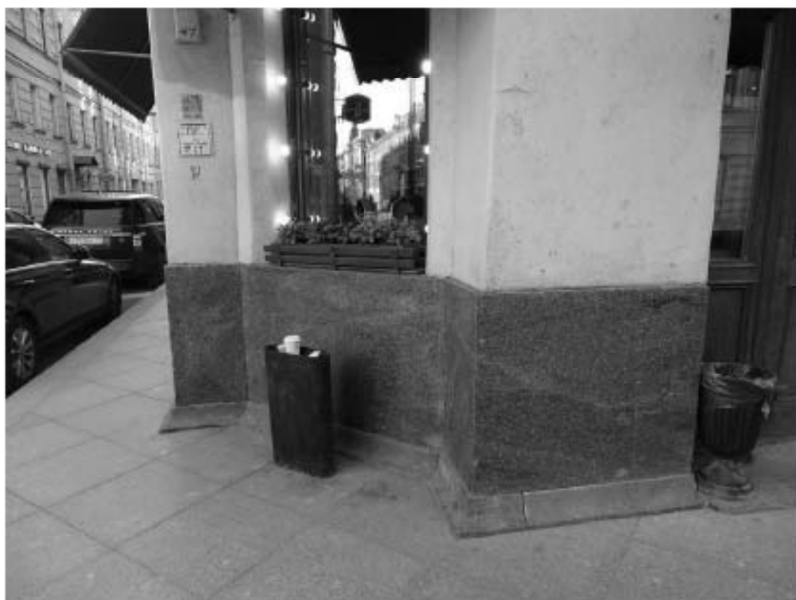
Фото 19. Здание по адресу: г. Санкт-Петербург, Большой проспект П.С., дом 74, литера А. Угловая часть здания (угол Большого пр. и ул. Подрезова). Съемка 19.04.2021 г. Михайловская Г. В.
