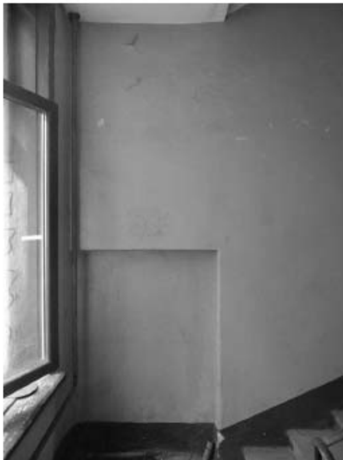
Фото 365. Лестница № 8: Площадка между 1-м и 2-м этажом. Ниша в стене. Съемка 19.04.2021 г. Михайловская Г. В.
