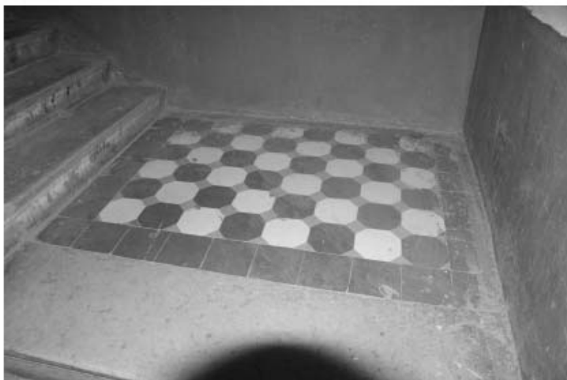
Фото 238. Лестница № 4: Площадка между 1-м и 2-м этажом. Покрытие пола. Съемка 19.04.2021 г. Михайловская Г. В.
