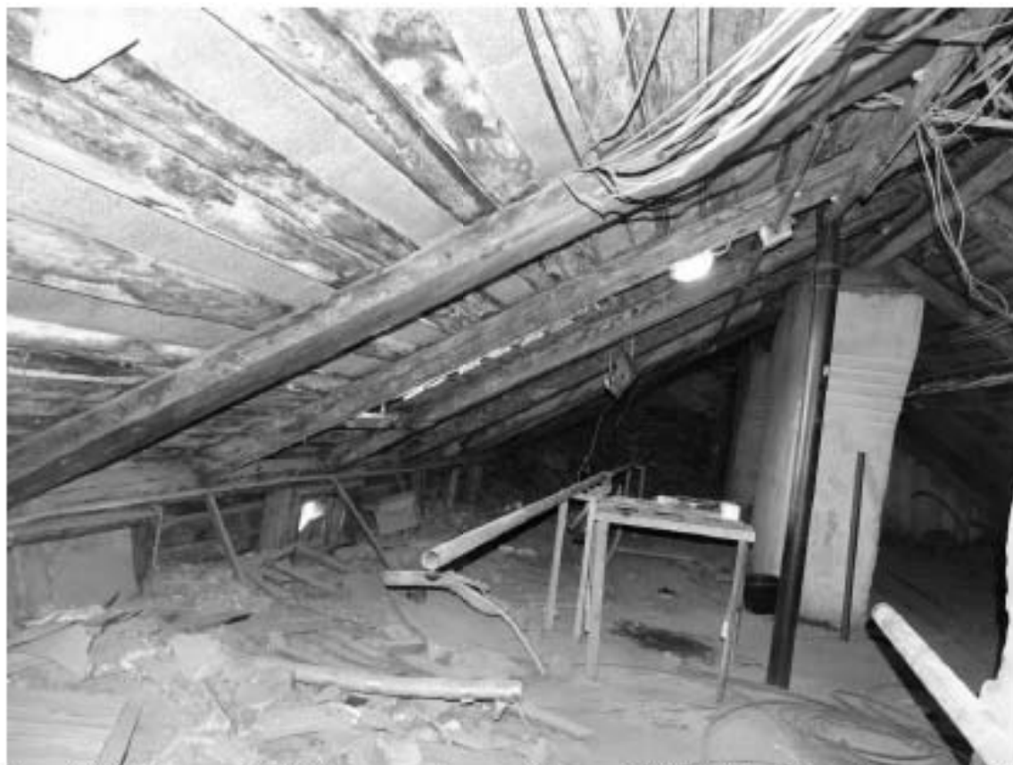
Фото 407. Лестница № 9: Чердачный этаж. Съемка 19.04.2021 г. Михайловская Г. В.
