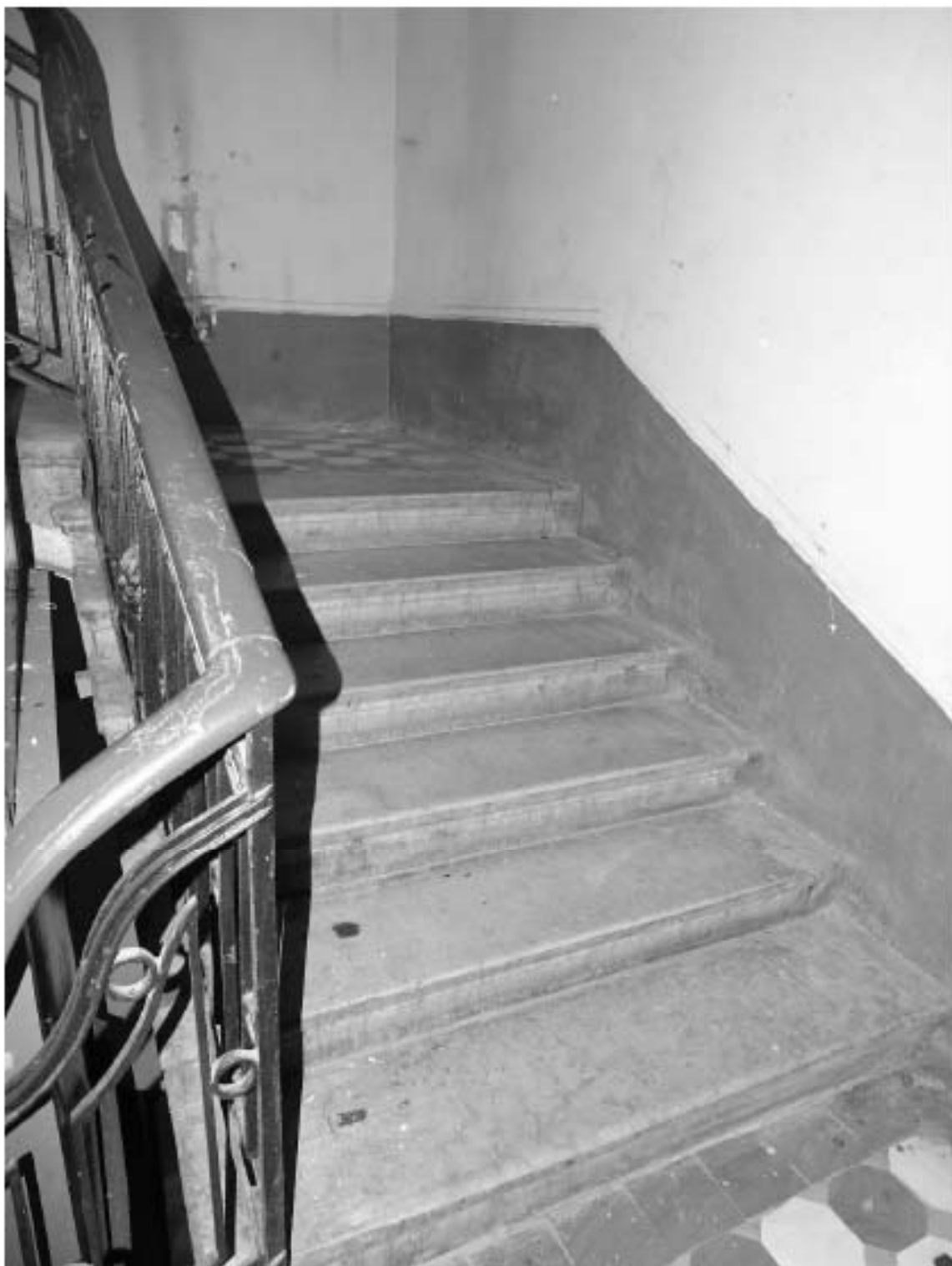
Фото 243. Лестница № 4: Лестничная площадка между 3-м и 4-м этажом. Съемка 19.04.2021 г. Михайловская Г. В.
