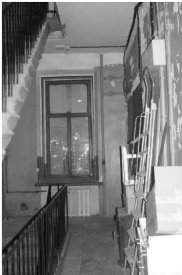
Фото 344. Лестница № 7: 4-й этаж. Съёмка 19.04.2021 г. Михайловская Г. В.
