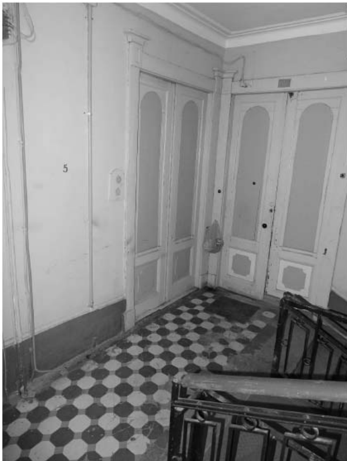
Фото 248. Лестница № 4: 5-й этаж. Съемка 19.04.2021 г. Михайловская Г. В.
