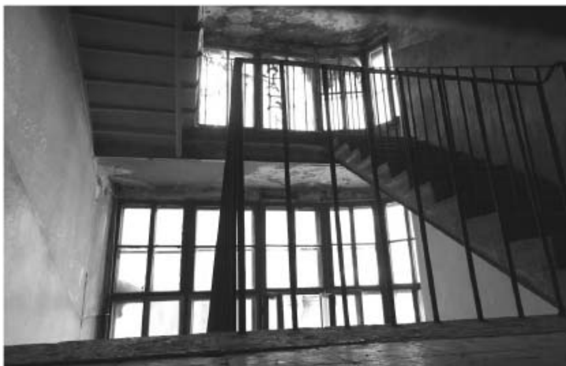
Фото 84. Лестница № 10: Вид на площадку между 7-м и чердачным этажом. Съемка 19.04.2021 г. Михайловская Г. В.
