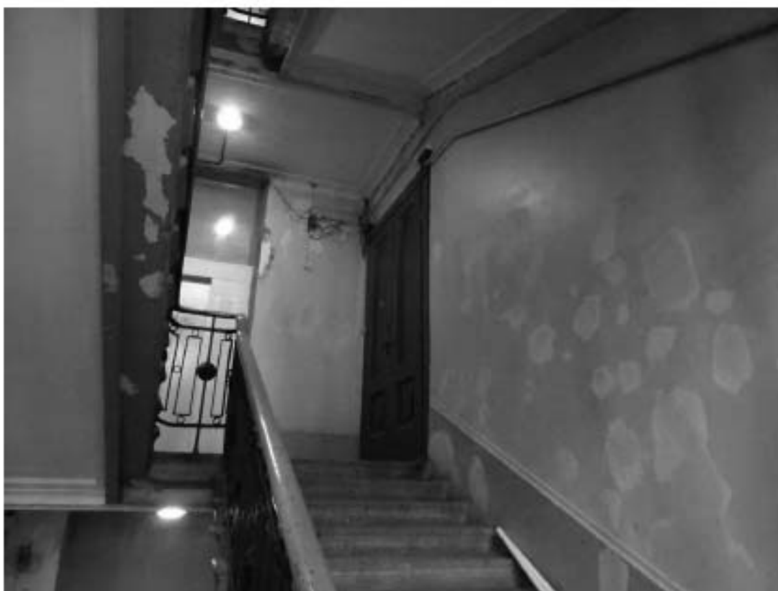
Фото 30. Лестница № 1: Площадка 5-го этажа. Съемка 19.04.2021 г. Михайловская Г. В.
