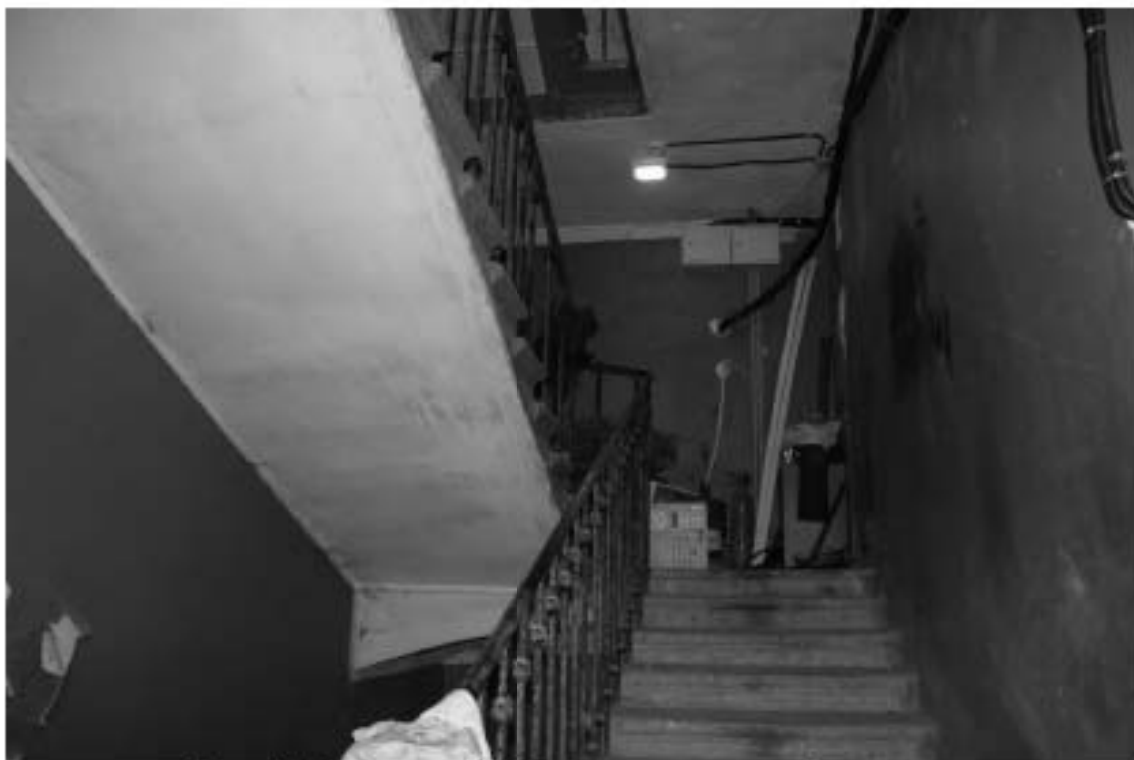
Фото 158. Лестница № 13: Вид на площадку 3-го этажа. Съемка 19.04.2021 г. Михайловская Г. В.
