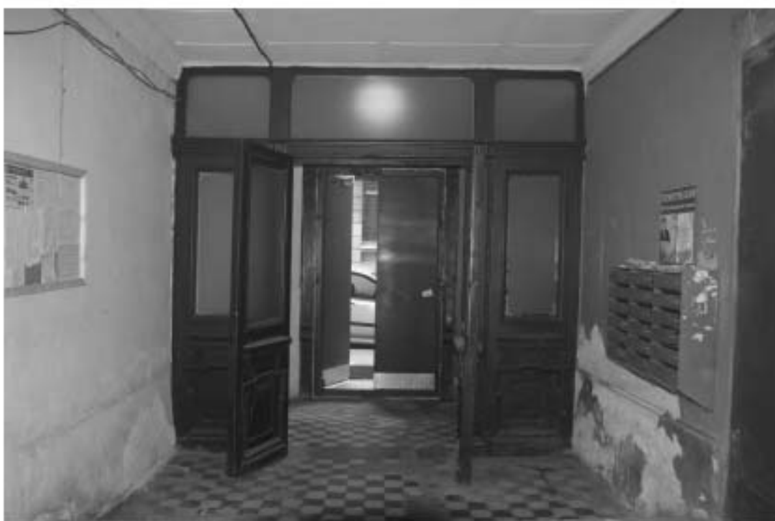
Фото 301. Лестница № 6: 1-й этаж. Вестибюль. Заполнение дверного проема. Съемка 19.04.2021 г. Михайловская Г. В.
