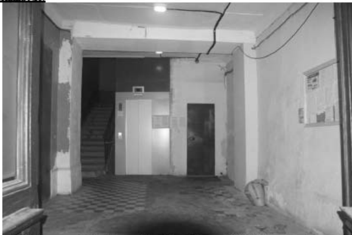
Фото 298. Лестница № 6: 1-й этаж. Вестибюль. Съемка 19.04.2021 г. Михайловская Г. В.
