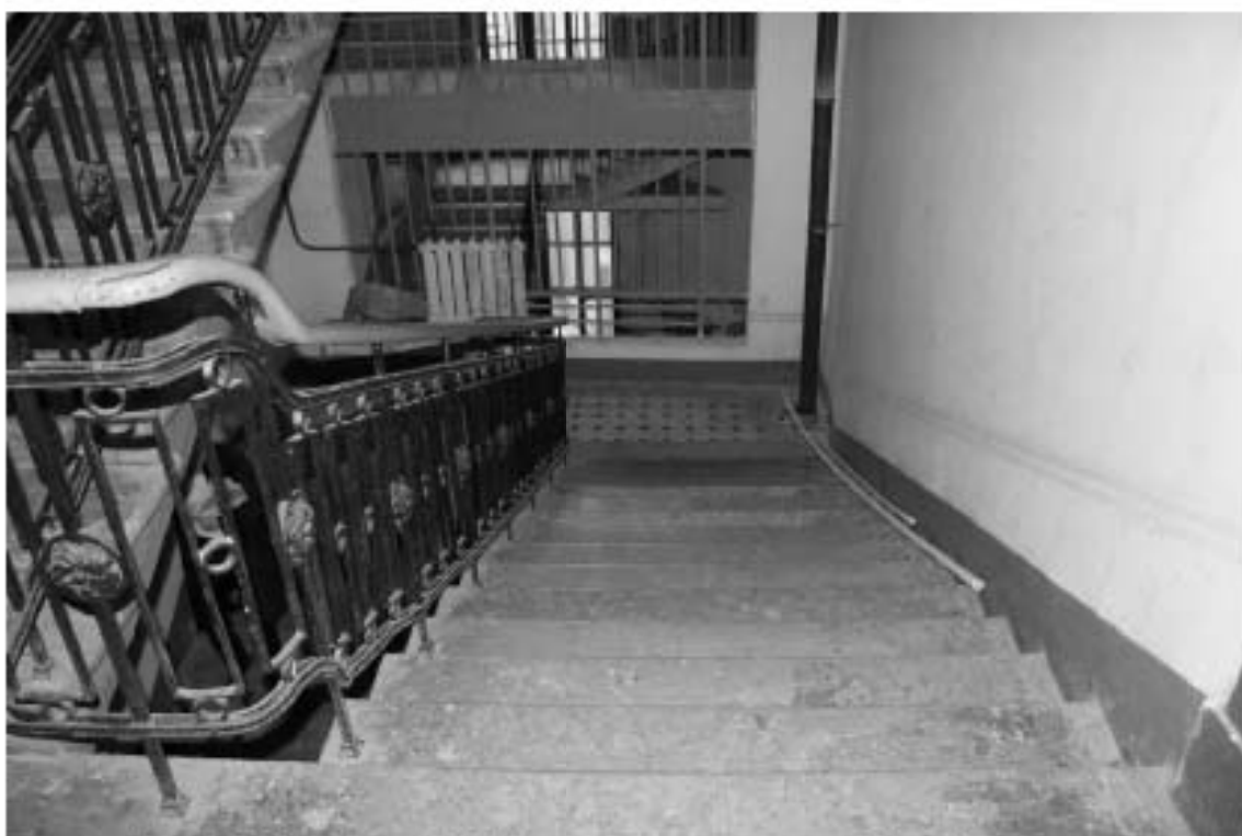
Фото 52. Лестница № 2: Вид на площадку между 3-м и 4-м этажом. Съемка 19.04.2021 г. Михайловская Г. В.
