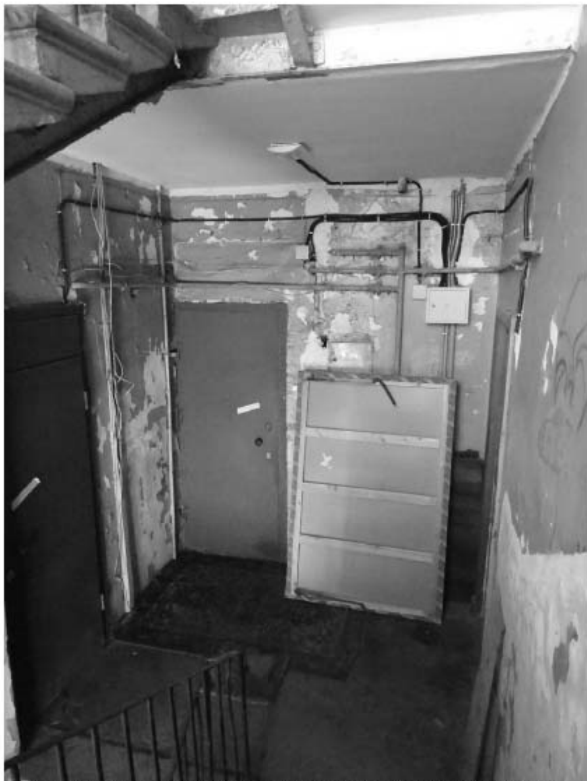
Фото 398. Лестница № 9: 6-й этаж. Съёмка 19.04.2021 г. Михайловская Г. В.
