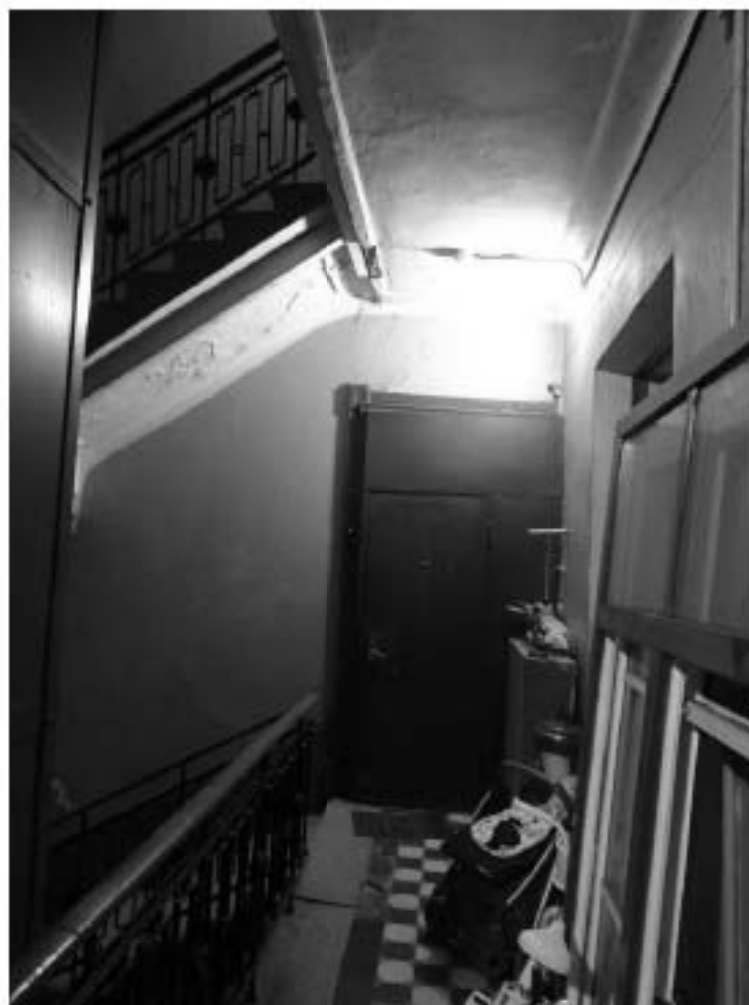
Фото 330. Лестница № 6: 6-й этаж. Съемка 19.04.2021 г. Михайловская Г. В.
