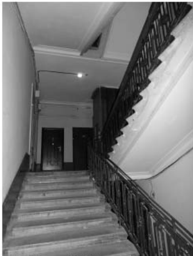
Фото 212. Лестница № 3: Вид на площадку 2-го этажа. Съемка 19.04.2021 г. Михайловская Г. В.
