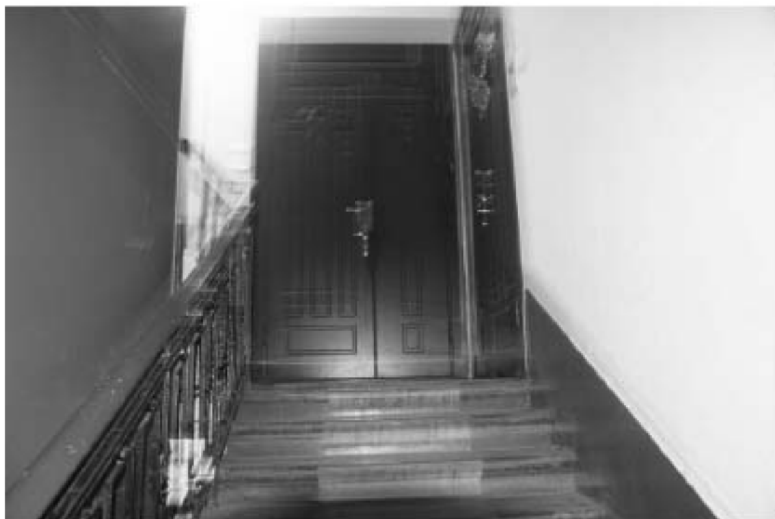
Фото 242. Лестница № 4: 3-й этаж. Съемка 19.04.2021 г. Михайловская Г. В.
