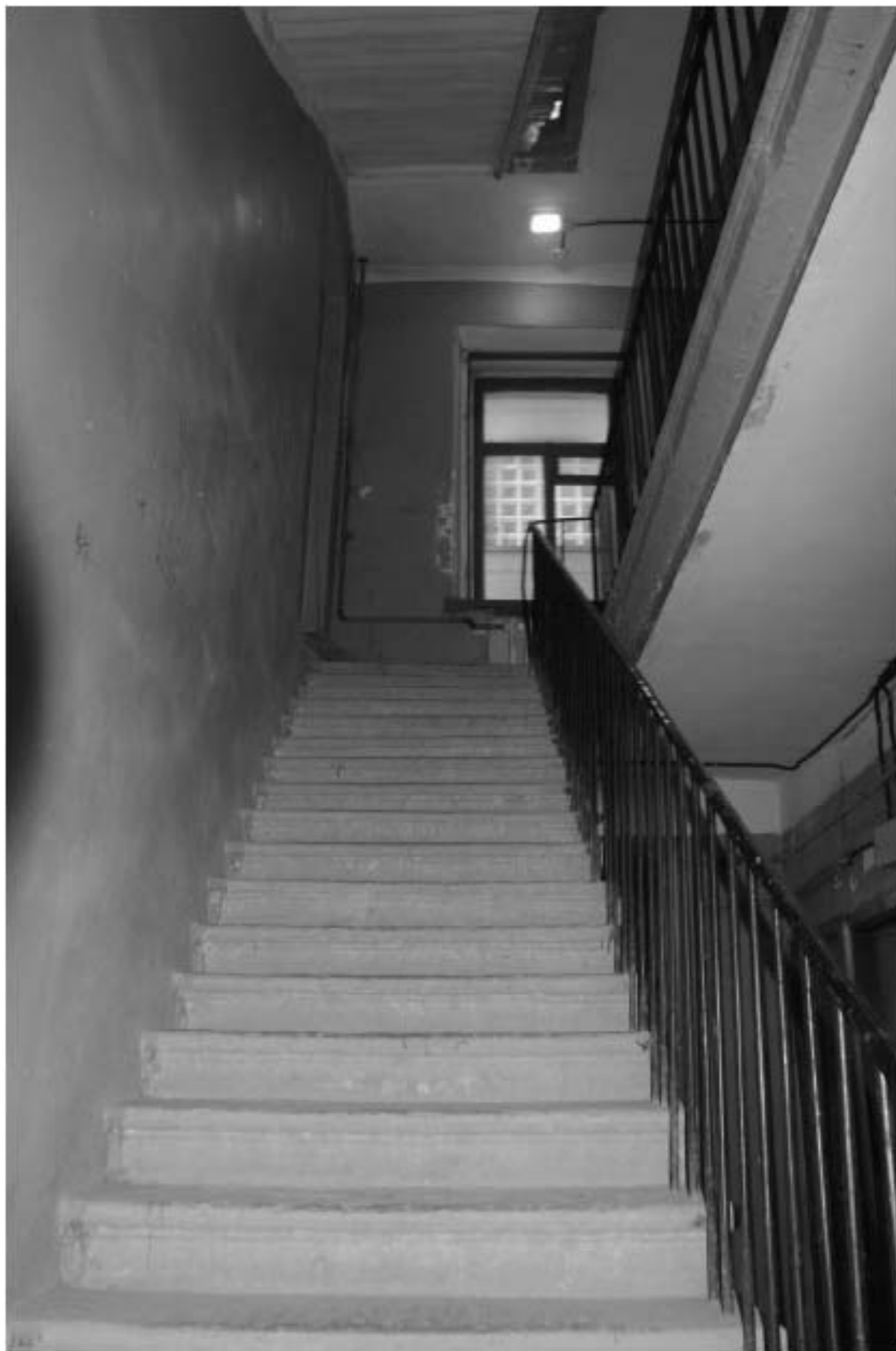
Фото 339. Лестница № 7: Лестничный марш на 2-й этаж. Съемка 19.04.2021 г. Михайловская Г. В.
