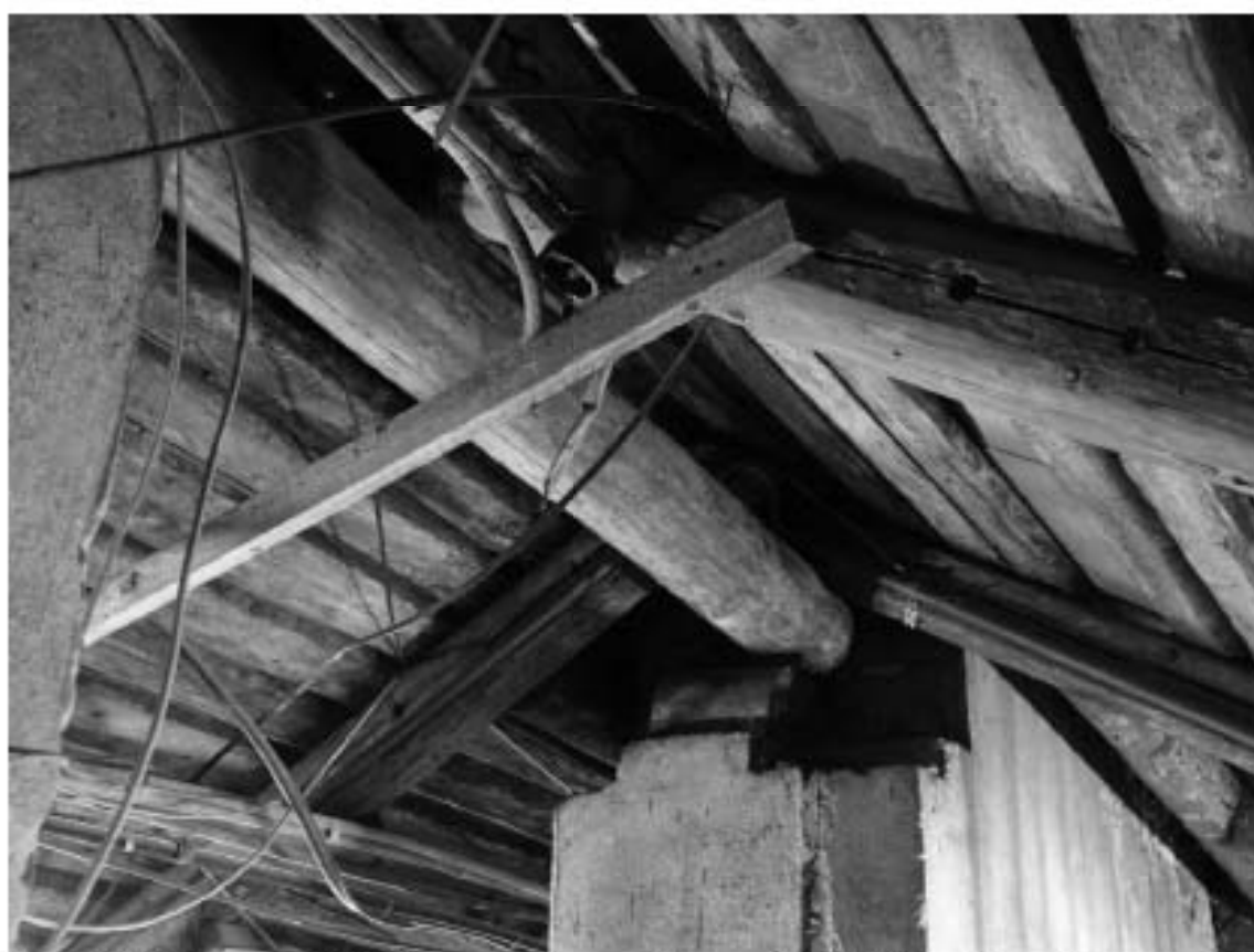
Фото 410. Лестница № 9: Чердачный этаж. Съемка 19.04.2021 г. Михайловская Г. В.
