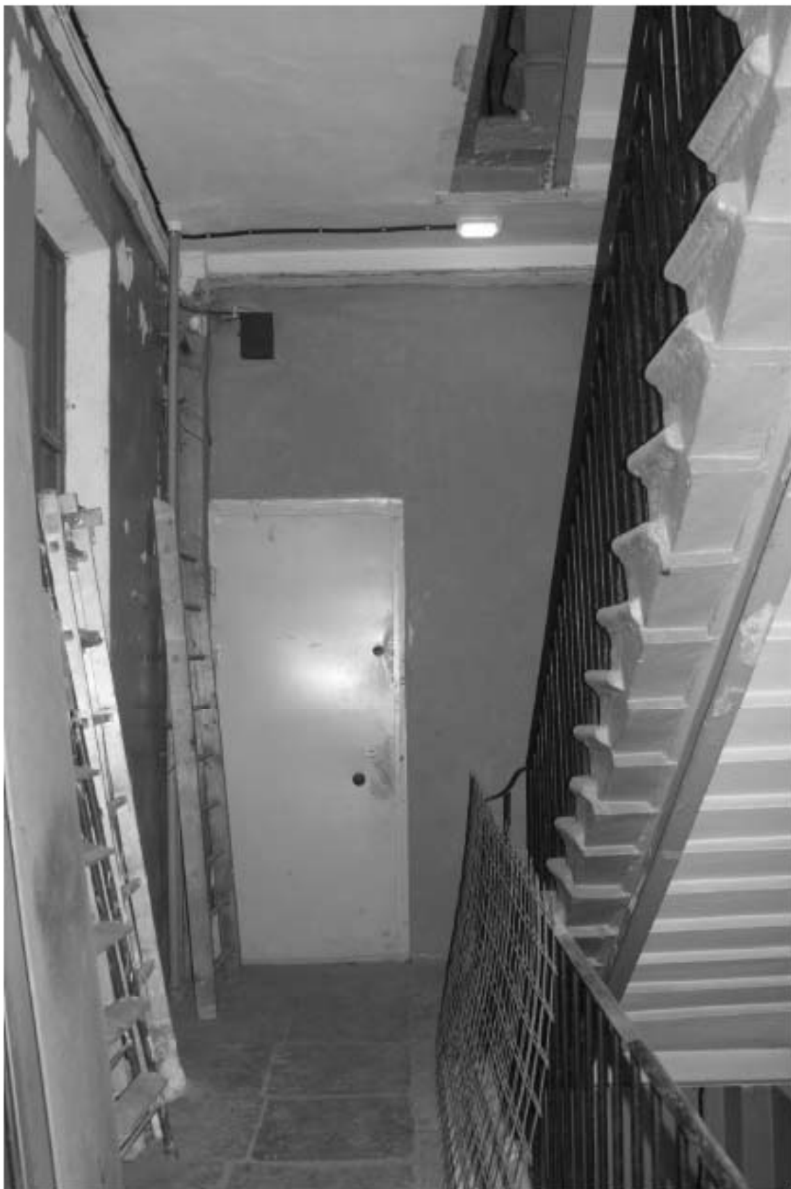
Фото 343. Лестница № 7: 3-й этаж. Съемка 19.04.2021 г. Михайловская Г. В.
