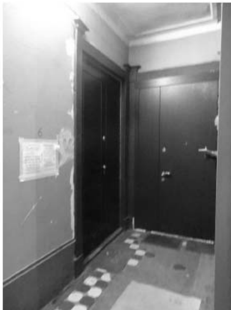
Фото 331. Лестница № 6: 6-й этаж. Съёмка 19.04.2021 г. Михайловская Г. В.
