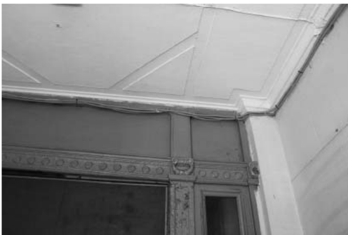
Фото 18. 1-й этаж. Вестибюль по Большому проспекту. Оформление двери. Съемка 19.04.2021 г. Михайловская Г. В.
