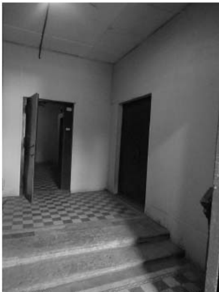
Фото 268. Лестница № 5: 1-й этаж. Вестибюль. Съемка 19.04.2021 г. Михайловская Г. В.
