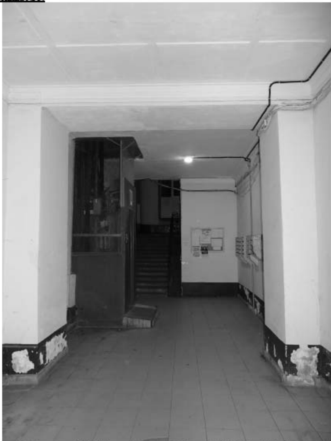
Фото 206. Лестница № 3: 1-й этаж. Вестибюль. Съемка 19.04.2021 г. Михайловская Г. В.
