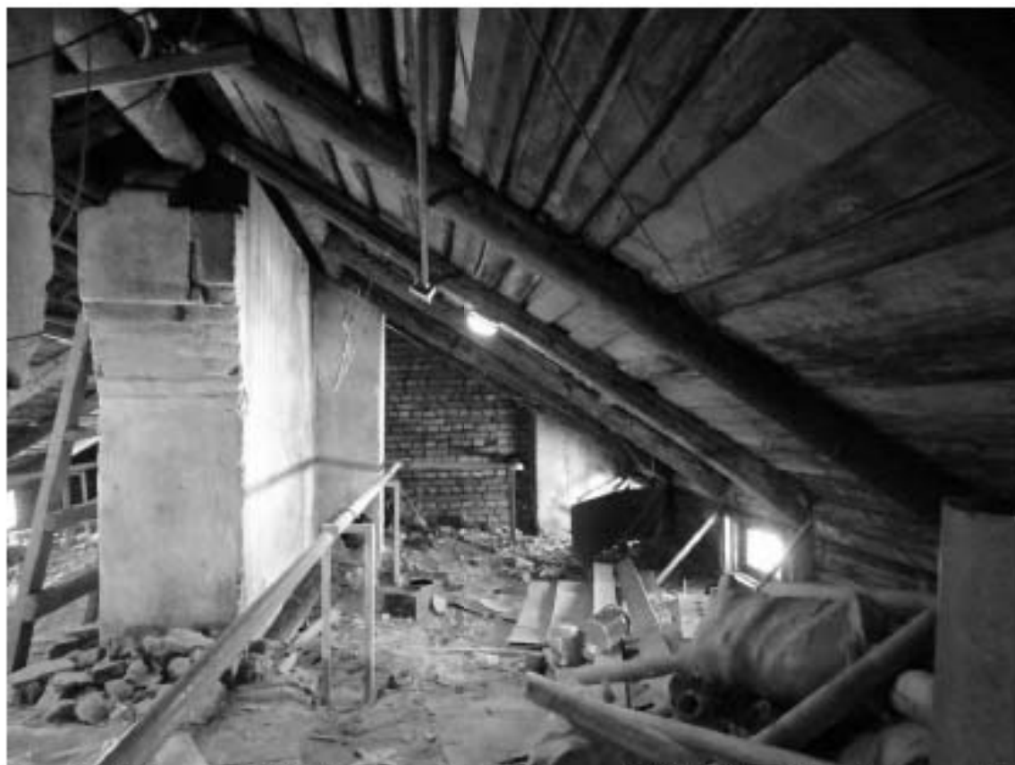
Фото 409. Лестница № 9: Чердачный этаж. Съемка 19.04.2021 г. Михайловская Г. В.
