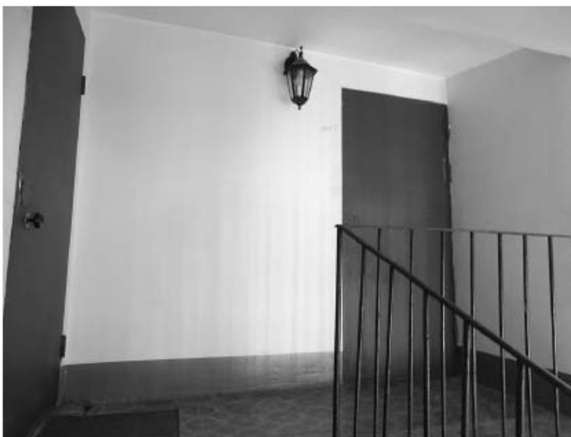
Фото 117. Лестница № 11: Площадка 8-го этажа. Съемка 19.04.2021 г. Михайловская Г. В.
