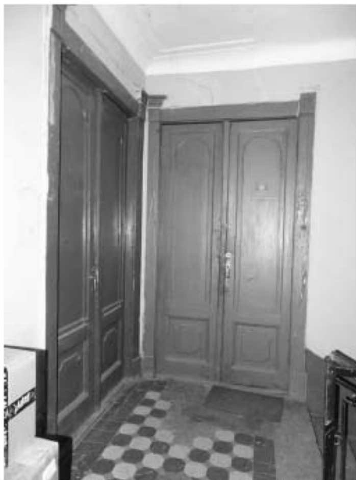
Фото 258. Лестница № 4: 7-й этаж. Съемка 19.04.2021 г. Михайловская Г. В.
