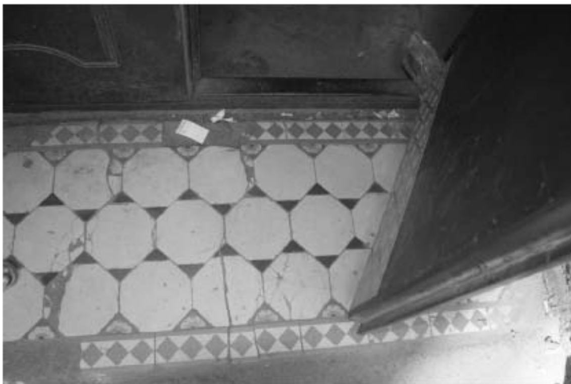
Фото 300. Лестница № 6: 1-й этаж. Покрытие пола перед входным тамбуром. Съемка 19.04.2021 г. Михайловская Г. В.
