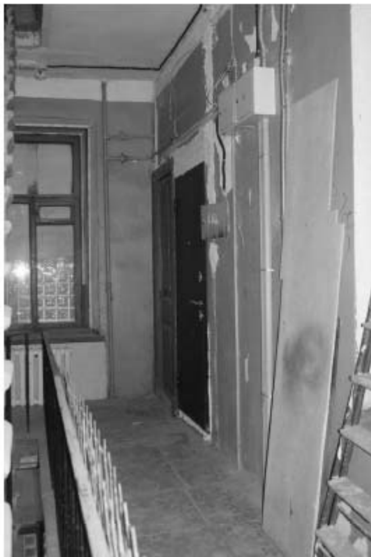
Фото 341. Лестница № 7: 2-й этаж. Съёмка 19.04.2021 г. Михайловская Г. В.
