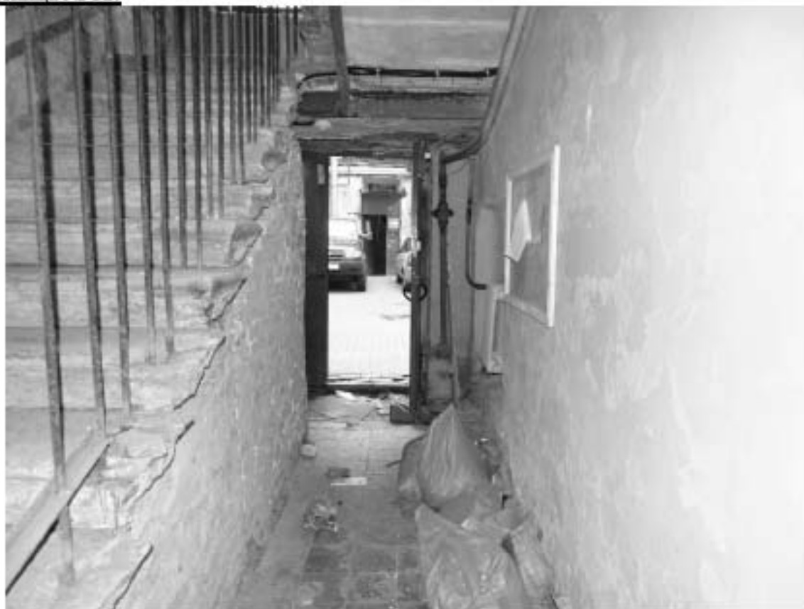
Фото 119. Лестница № 12: Вестибюль 1-го этажа. Съемка 19.04.2021 г. Михайловская Г. В.
