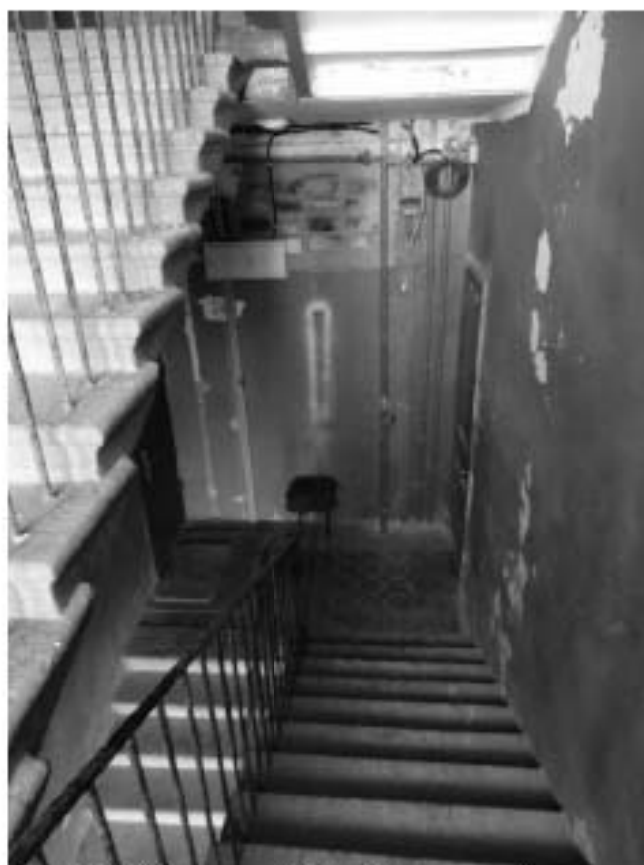
Фото 134. Лестница № 12: Площадка 5-го этажа. Съемка 19.04.2021 г. Михайловская Г. В.
