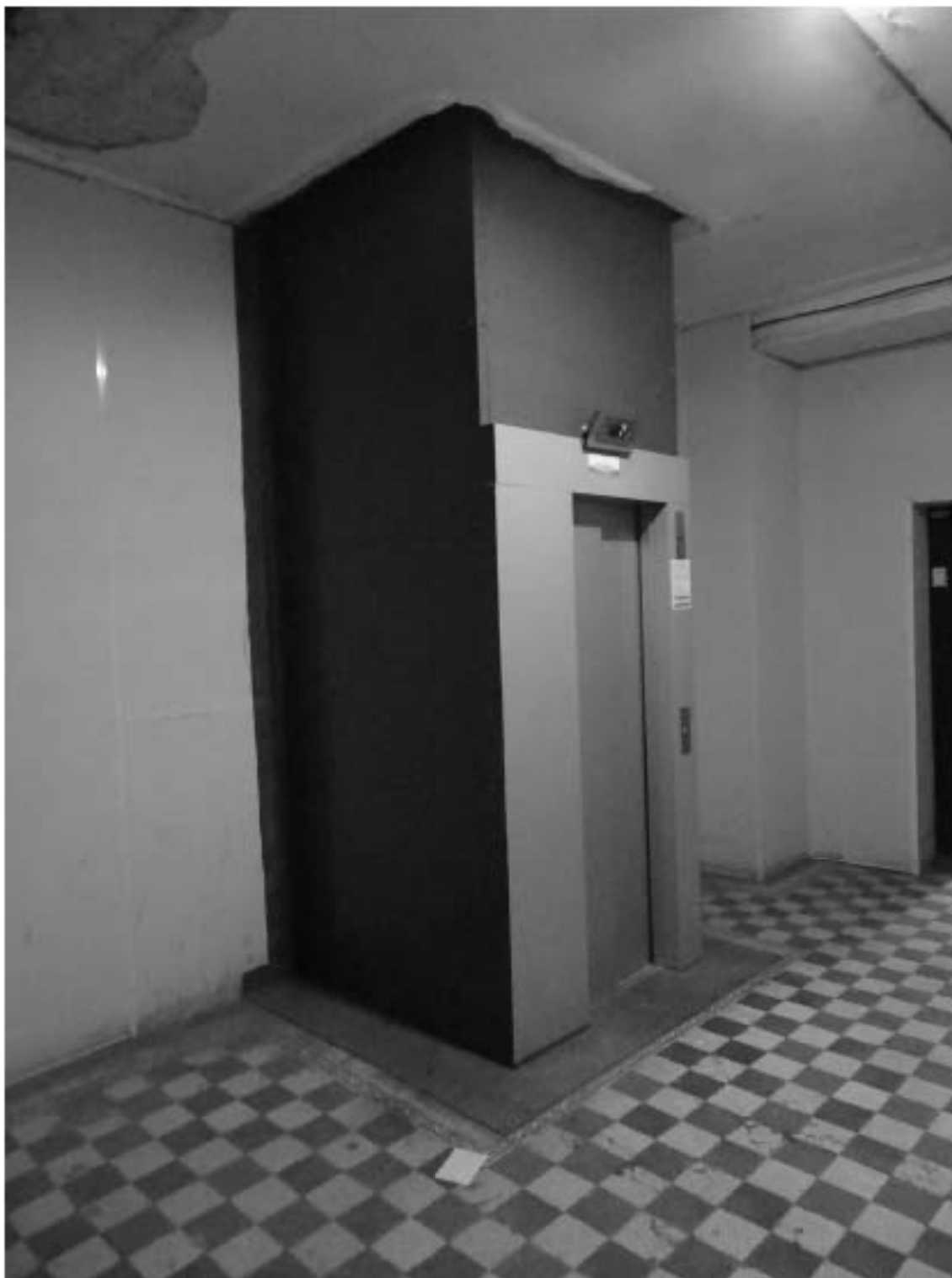
Фото 271. Лестница № 5: 1-й этаж. Вестибюль. Лифтовая шахта. Съемка 19.04.2021 г. Михайловская Г. В.
