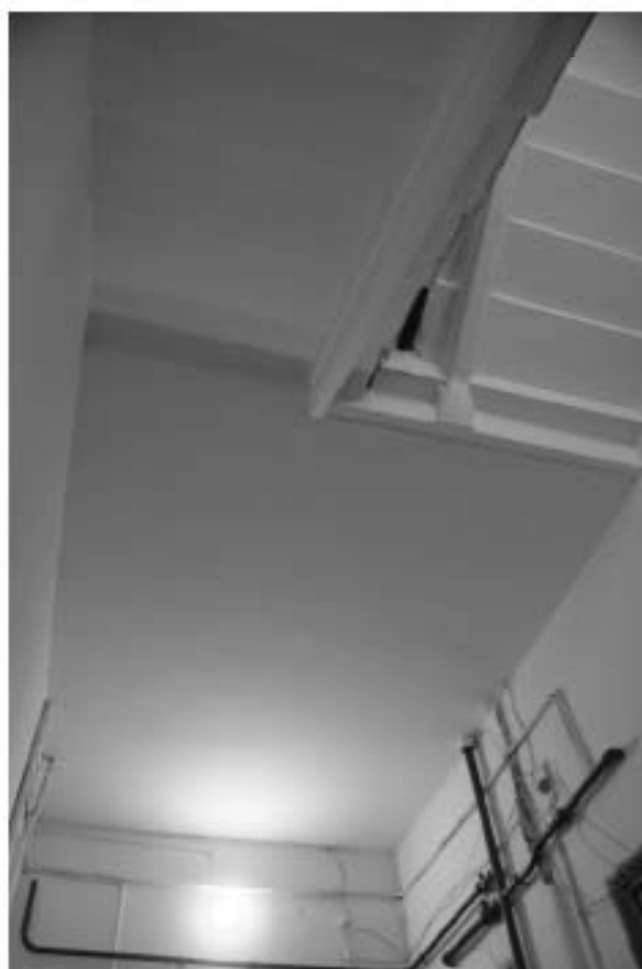
Фото 96. 6ЛК. Площадка 3-го этажа. Съемка 19.04.2021 г. Михайловская Г. В.
