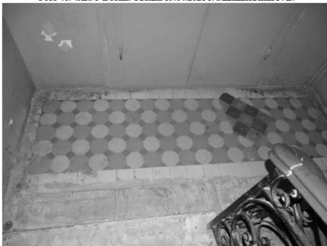
Фото 47. 4ЛК. 3-й этаж. Покрытие пола. Съёмка 19.04.2021 г. Михайловская Г. В.
