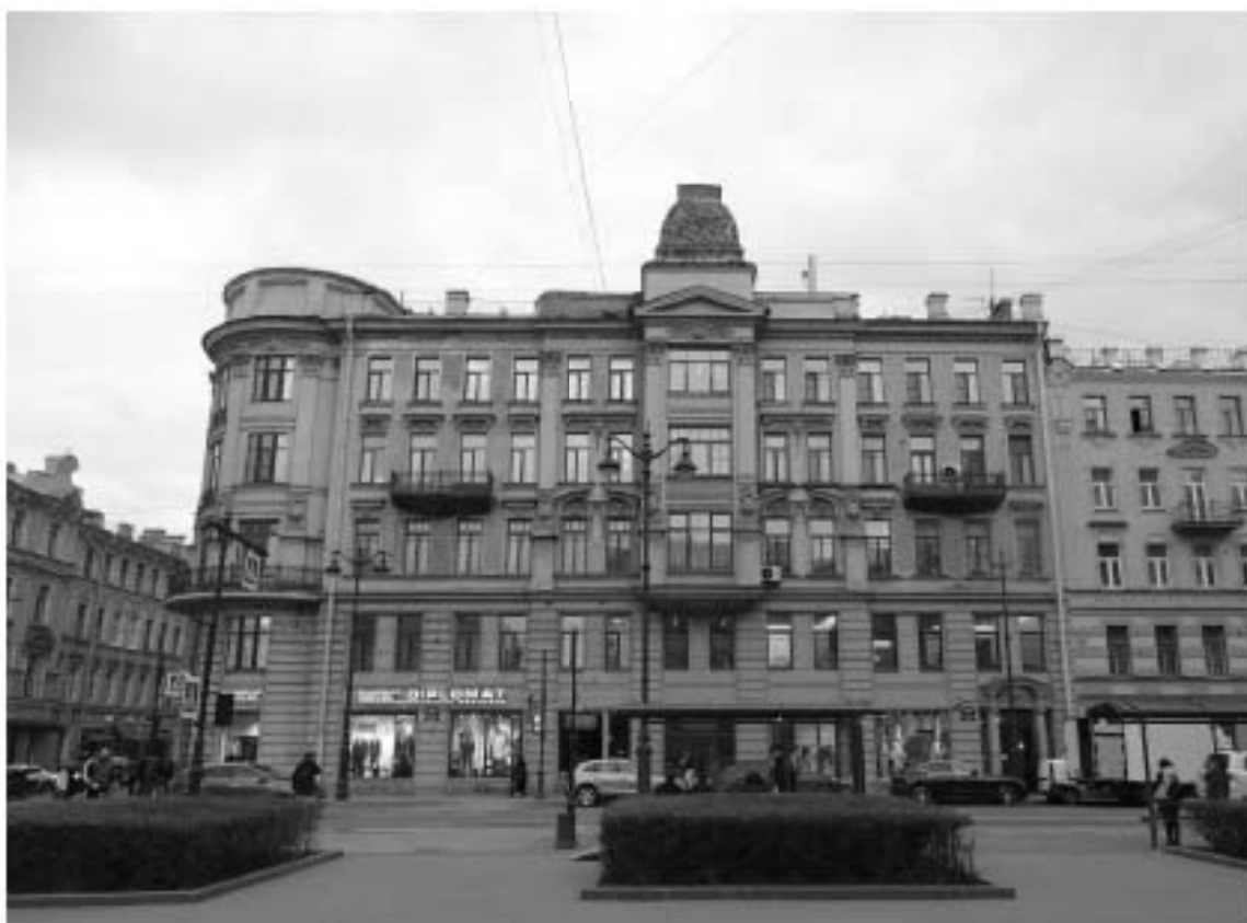
Фото 2. Здание по адресу: г. Санкт-Петербург, Большой проспект П.С., дом 49/18, литера А. Лицевой фасад по Большому пр. Съемка 19.04.2021 г. Михайловская Г. В.
