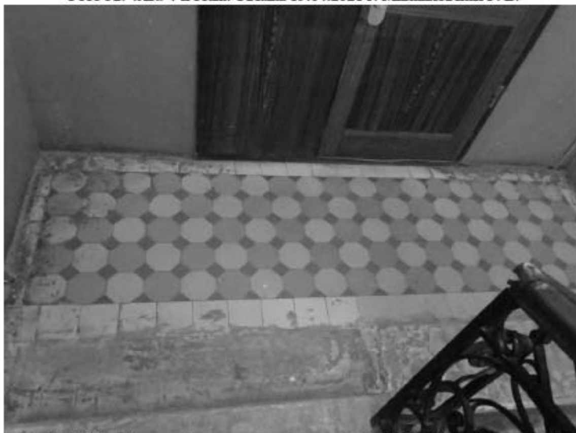
Фото 53. 4ЛК. 4-й этаж. Покрытие пола. Съемка 19.04.2021 г. Михайловская Г. В.
