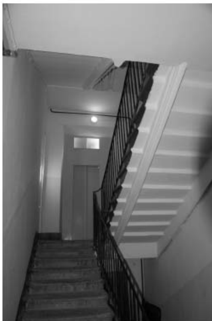
Фото 91. БЛК. Площадка между 2-м и 3-м этажом. Съемка 19.04.2021 г. Михайловская Г. В.
