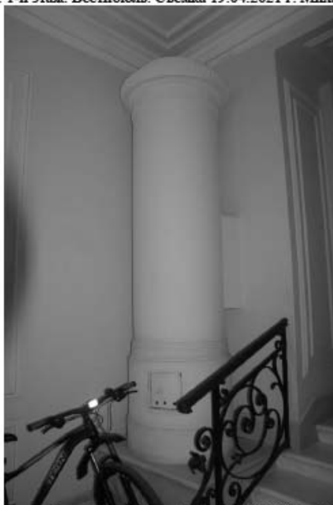
Фото 29. 4ЛК. 1-й этаж. Вестибюль. Печь. Съемка 19.04.2021 г. Михайловская Г. В.
