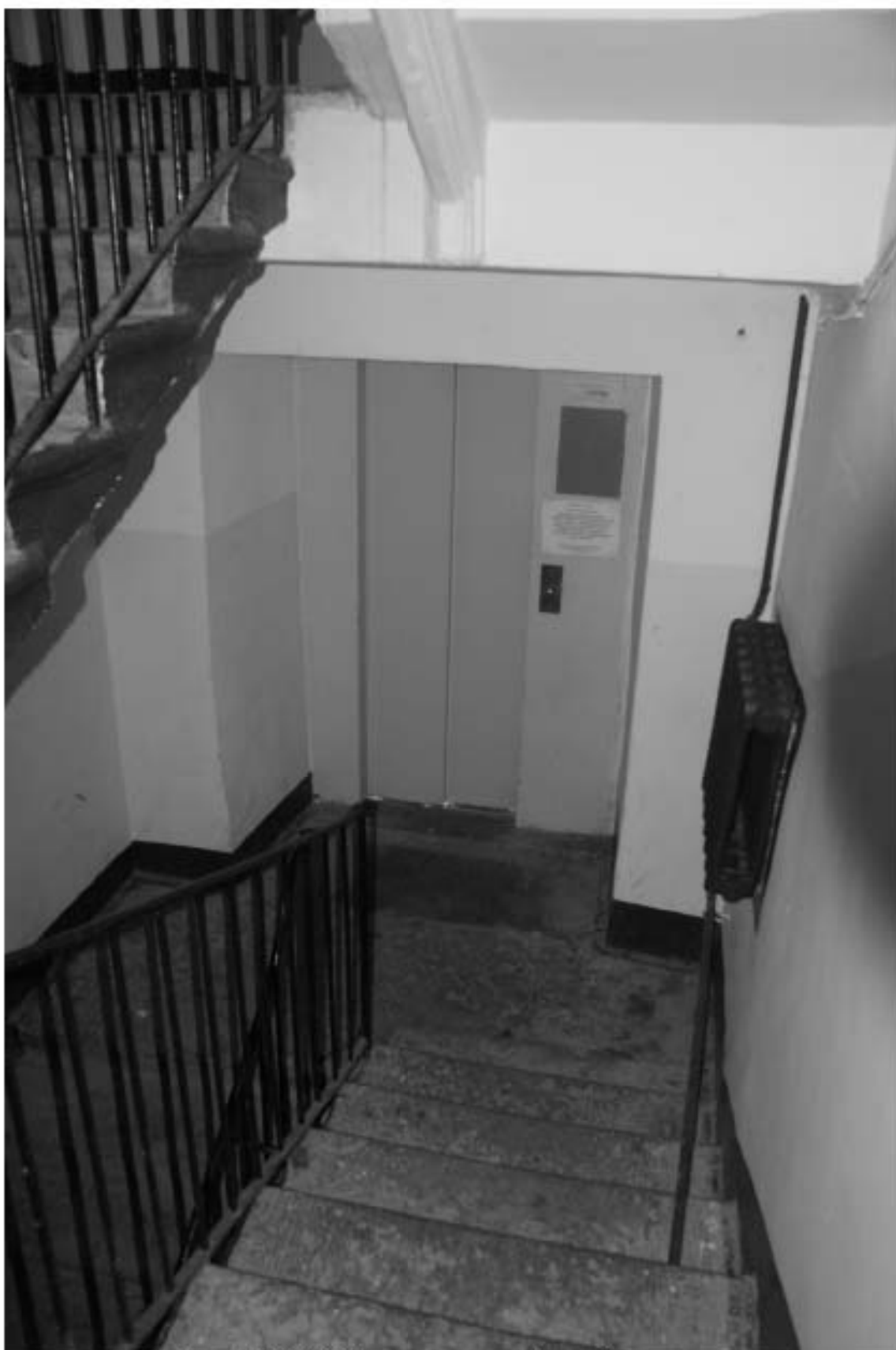
Фото 89. БЛК. Площадка между 1-м и 2-м этажом. Съемка 19.04.2021 г. Михайловская Г. В.
