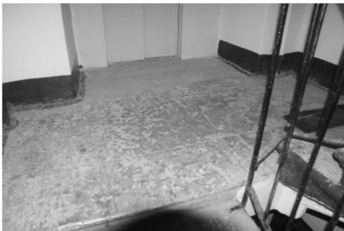
Фото 93. 6ЛК. Площадка между 2-м и 3-м этажом. Покрытие пола. Съемка 19.04.2021 г. Михайловская Г. В.
