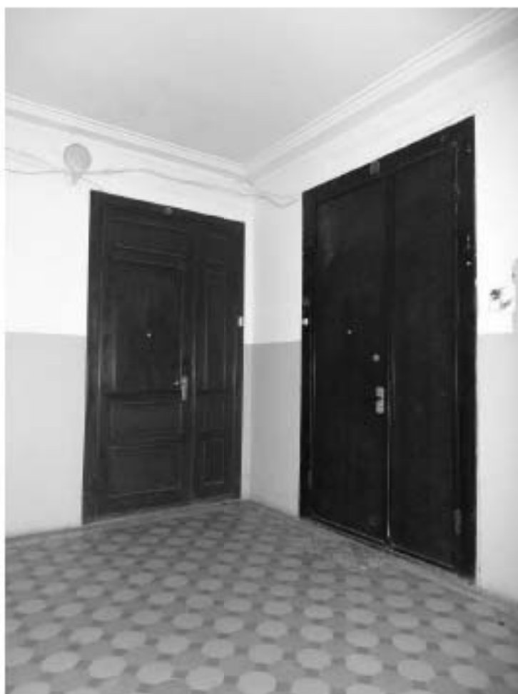
Фото 73. 1ЛК. 1-й этаж. Съемка 19.04.2021 г. Михайловская Г. В.
