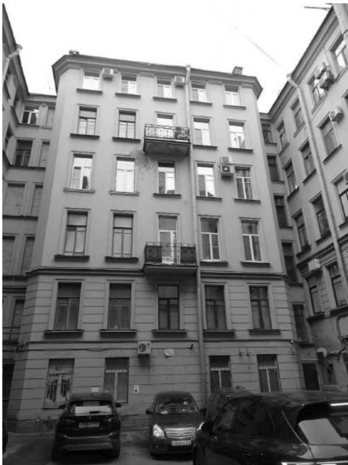
Фото 12. Здание по адресу: г. Санкт-Петербург, Большой проспект П.С., дом 49/18, литера А. Западный внутренний двор. Съемка 19.04.2021 г. Михайловская Г. В.
