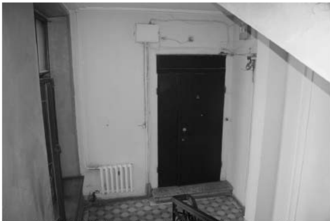
Фото 43. 4ЛК. 2-й этаж. Съемка 19.04.2021 г. Михайловская Г. В.
