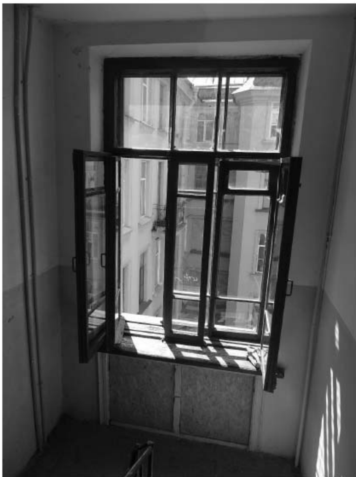
Фото 126. 5ЛК. Площадка между 4-м и 5-м этажом. Съемка 19.04.2021 г. Михайловская Г. В.
