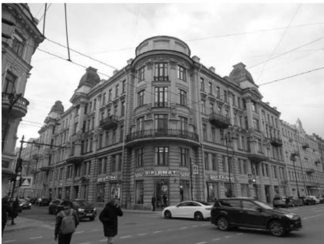
Фото 1. Здание по адресу: г. Санкт-Петербург, Большой проспект П.С., дом 49/18, литера А. Вид с пересечения Большого пр. и ул. Ленина. Съемка 19.04.2021 г. Михайловская Г. В.
