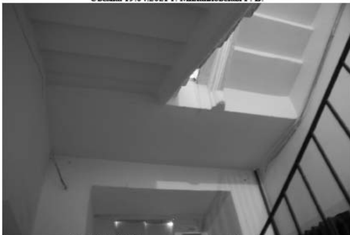
Фото 88. 6ЛК. Площадка между 1-м и 2-м этажом. Съемка 19.04.2021 г. Михайловская Г. В.
