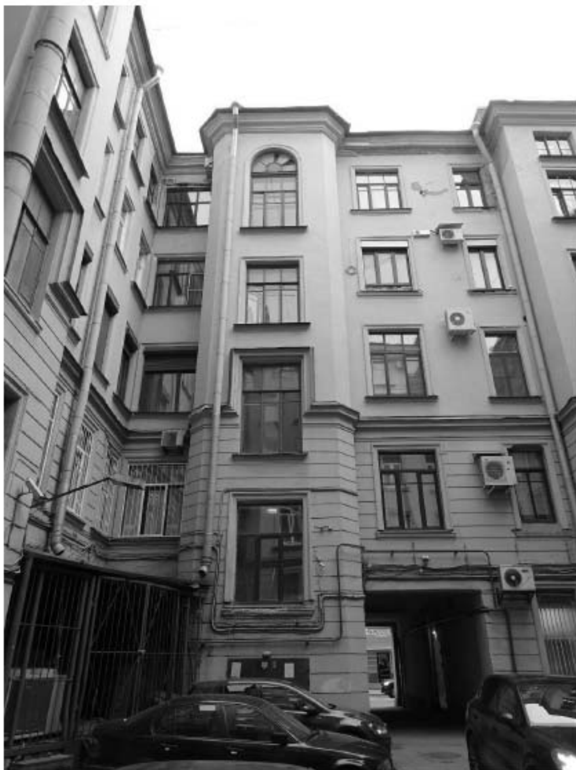
Фото 14. Здание по адресу: г. Санкт-Петербург, Большой проспект П.С., дом 49/18, литера А. Западный внутренний двор. Съемка 19.04.2021 г. Михайловская Г. В.
