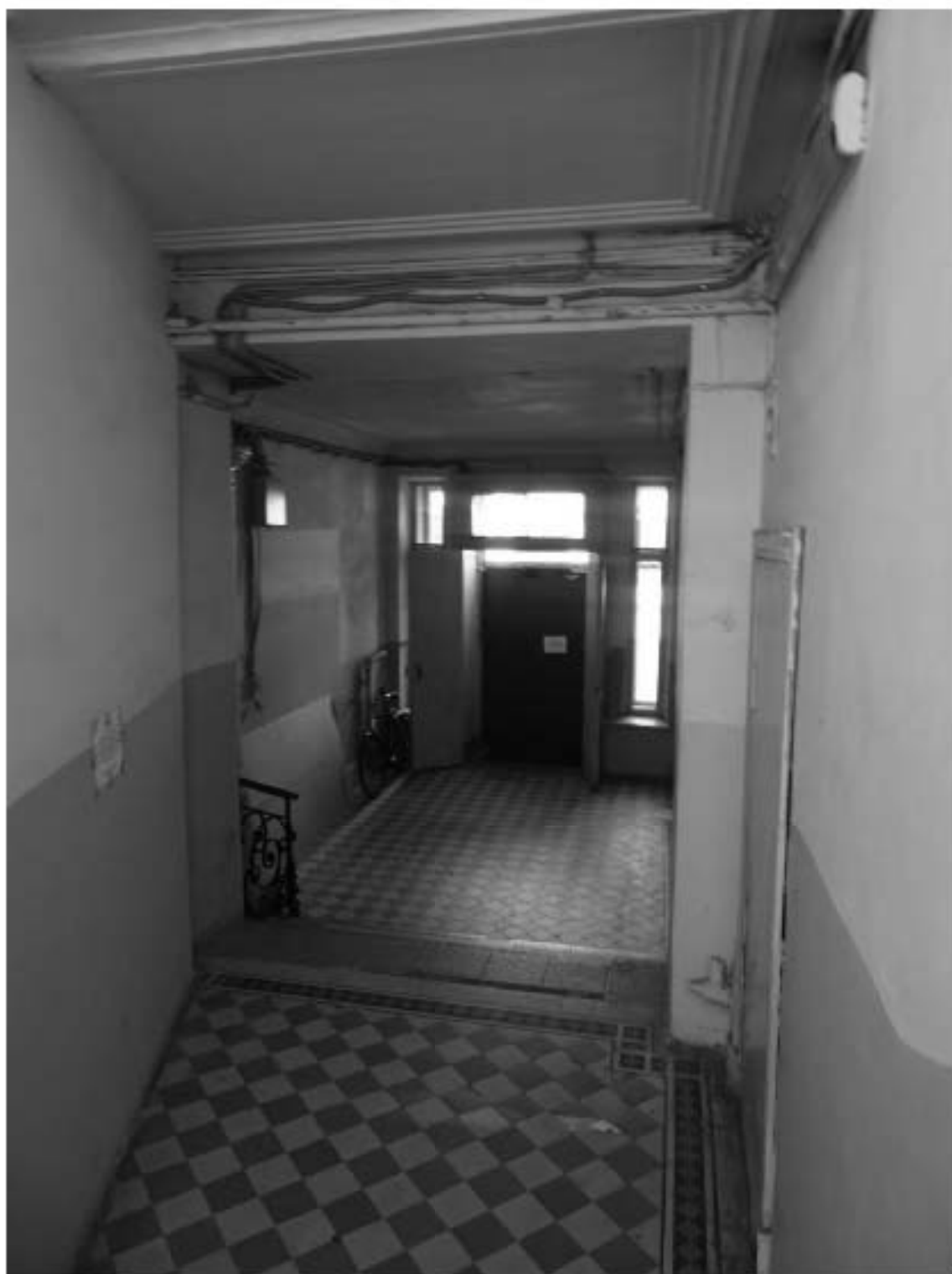
Фото 12. 2ЛК. 1-й этаж. Вестибюль. Съемка 19.04.2021 г. Михайловская Г. В.
