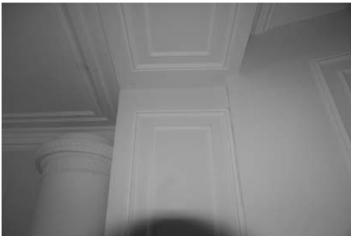
Фото 32. 4ЛК. 1-й этаж. Вестибюль. Оформление стен. Съемка 19.04.2021 г. Михайловская Г. В.
