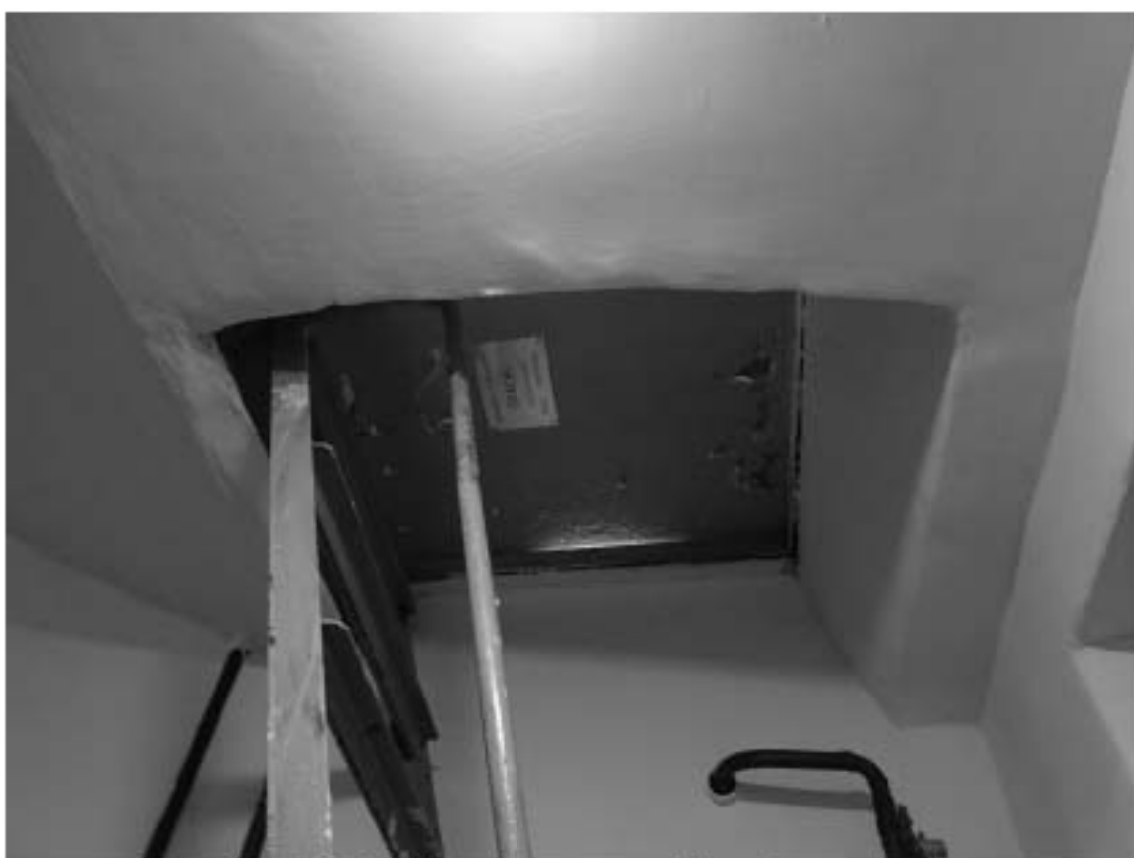
Фото 108. 6ЛК. Площадка между 5-м и 6-м этажом. Съемка 19.04.2021 г. Михайловская Г. В.
