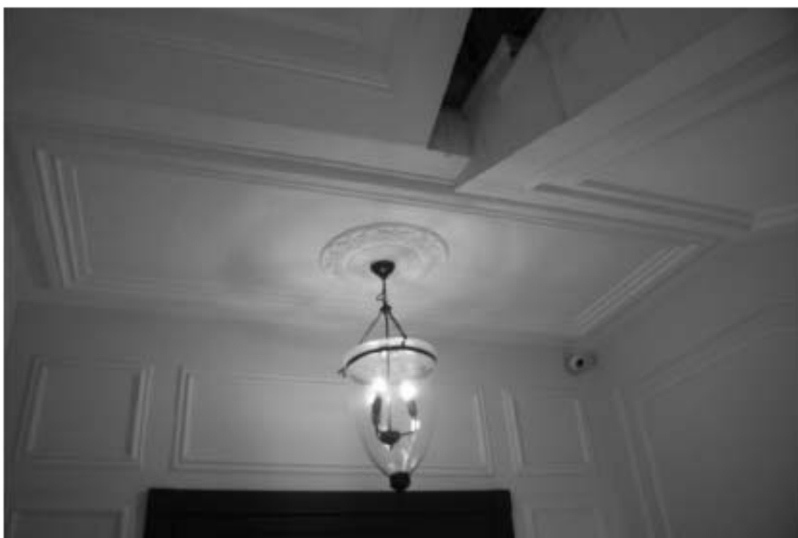
Фото 42. 4ЛК. 2-й этаж. Оформление потолка. Съемка 19.04.2021 г. Михайловская Г. В.
