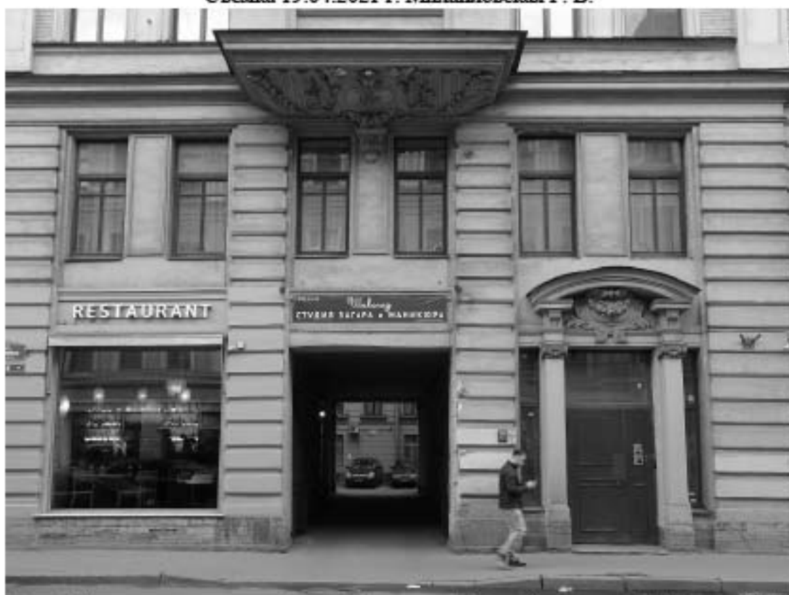
Фото 7. Здание по адресу: г. Санкт-Петербург, Большой проспект П.С., дом 49/18, литера А. Лицевой фасад по ул. Ленина. Фрагмент. Съемка 19.04.2021 г. Михайловская Г. В.
