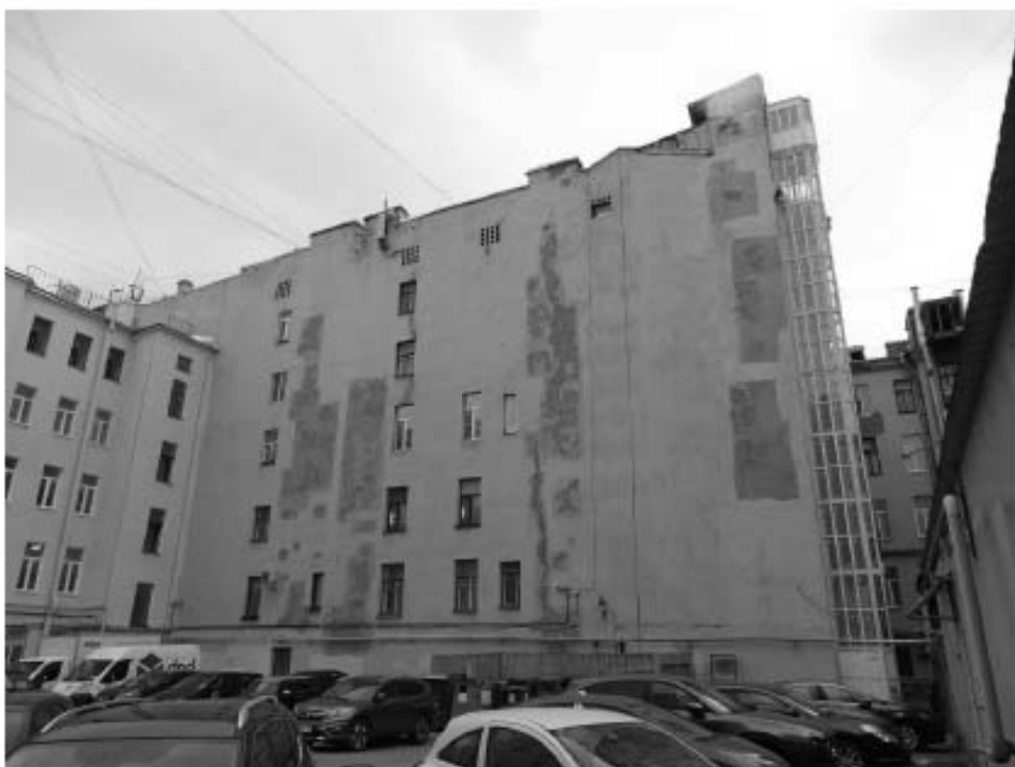
Фото 19. Здание по адресу: г. Санкт-Петербург, Большой проспект П.С., дом 49/18, литера А. Южный торцевой фасад. Съемка 19.04.2021 г. Михайловская Г. В.
