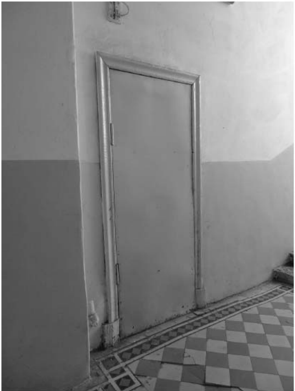
Фото 11. 2ЛК. 1-й этаж. Вестибюль. Съемка 19.04.2021 г. Михайловская Г. В.
