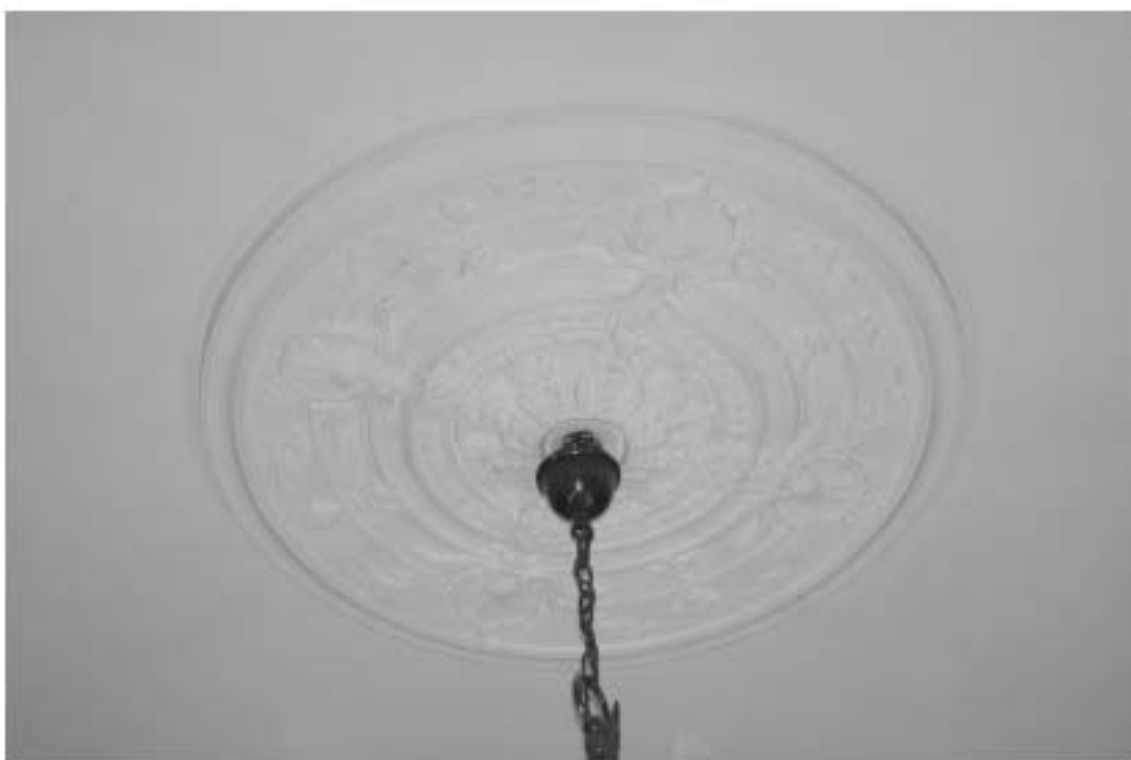
Фото 33. 4ЛК. 1-й этаж. Вестибюль. Розетка. Съемка 19.04.2021 г. Михайловская Г. В.
