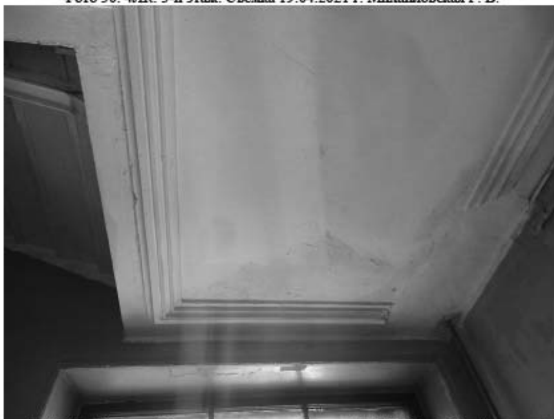
Фото 51. 4ЛК. 3-й этаж. Оформление потолка. Съемка 19.04.2021 г. Михайловская Г. В.
