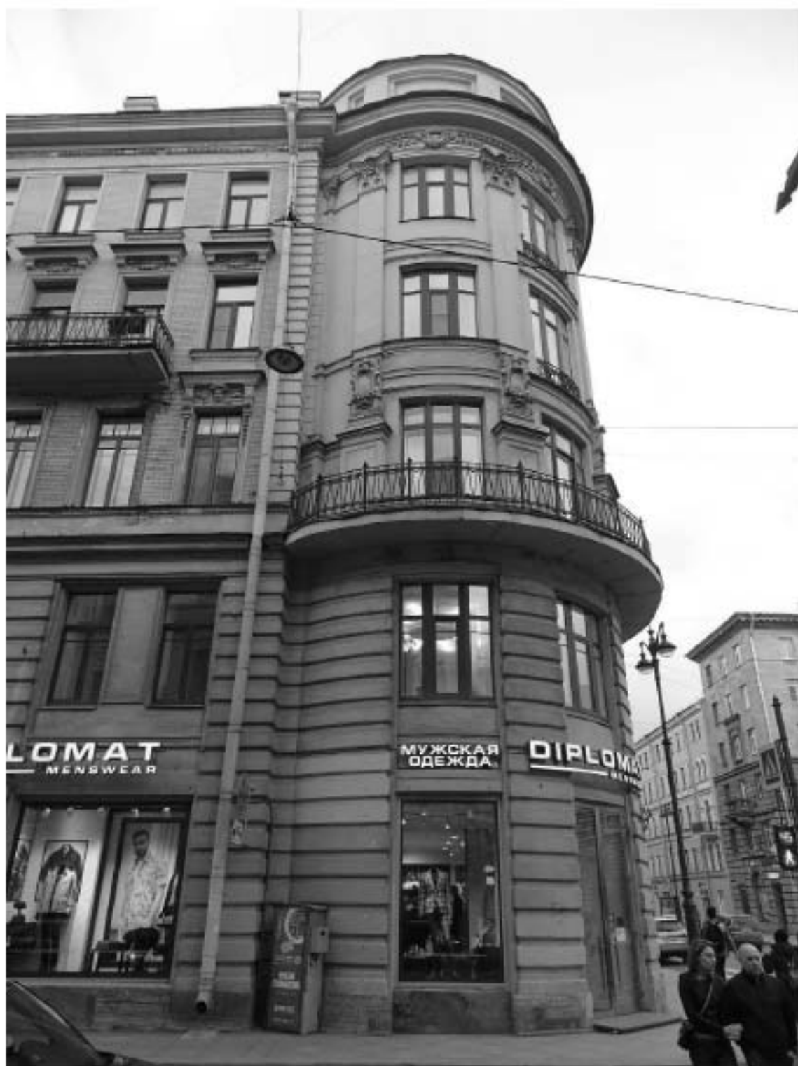
Фото 5. Здание по адресу: г. Санкт-Петербург, Большой проспект П.С., дом 49/18, литера А. Угловая часть здания. Съемка 19.04.2021 г. Михайловская Г. В.
