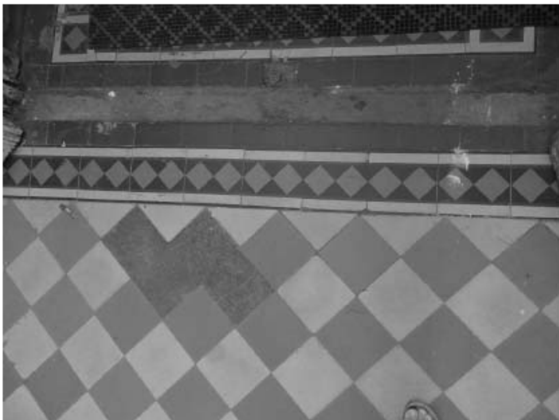
Фото 9. 2ЛК. 1-й этаж. Вестибюль. Фрагмент покрытия пола у входного тамбура. Съемка 19.04.2021 г. Михайловская Г. В.
