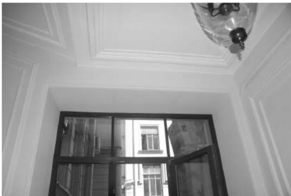
Фото 40. 4ЛК. 1-й этаж. Съемка 19.04.2021 г. Михайловская Г. В.
