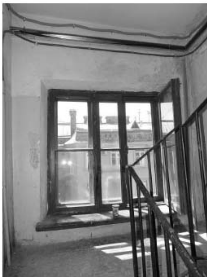
Фото 128. 5ЛК. Площадка между 5-м и 6-м этажом. Съемка 19.04.2021 г. Михайловская Г. В.
