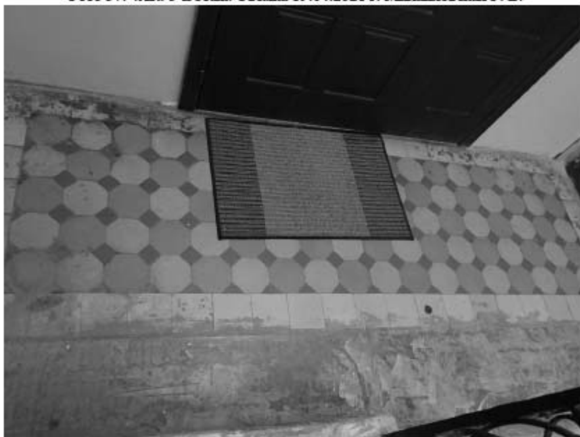
Фото 58. 4ЛК. 5-й этаж. Покрытие пола. Съёмка 19.04.2021 г. Михайловская Г. В.
