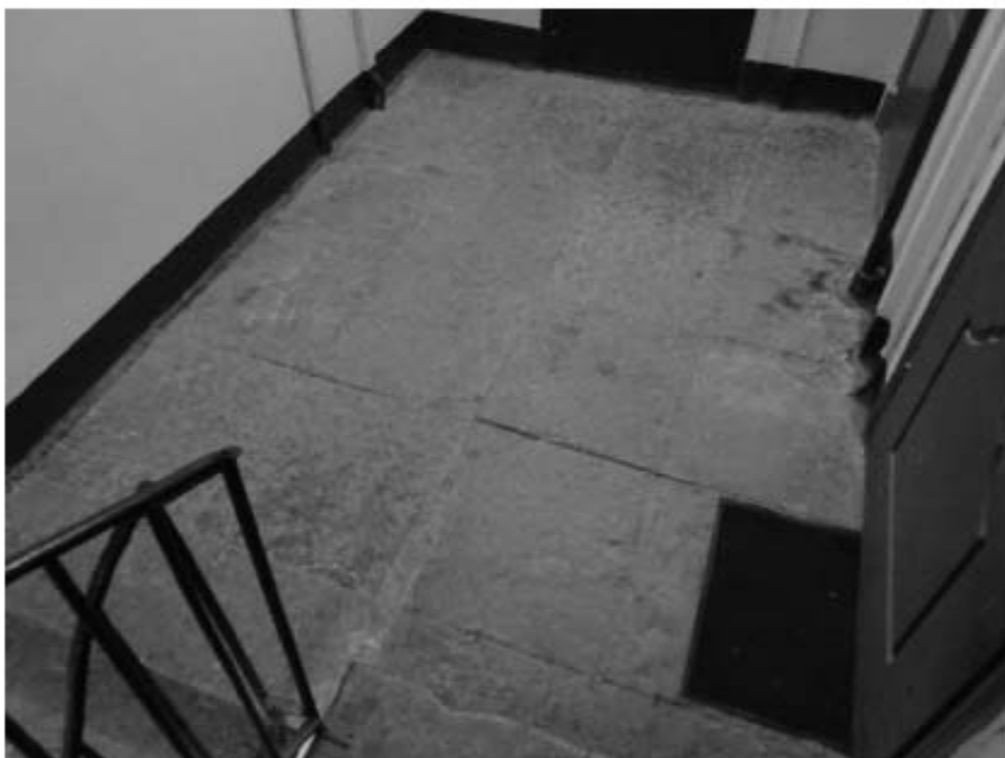
Фото 100. 6ЛК. 4-й этаж. Съемка 19.04.2021 г. Михайловская Г. В.
