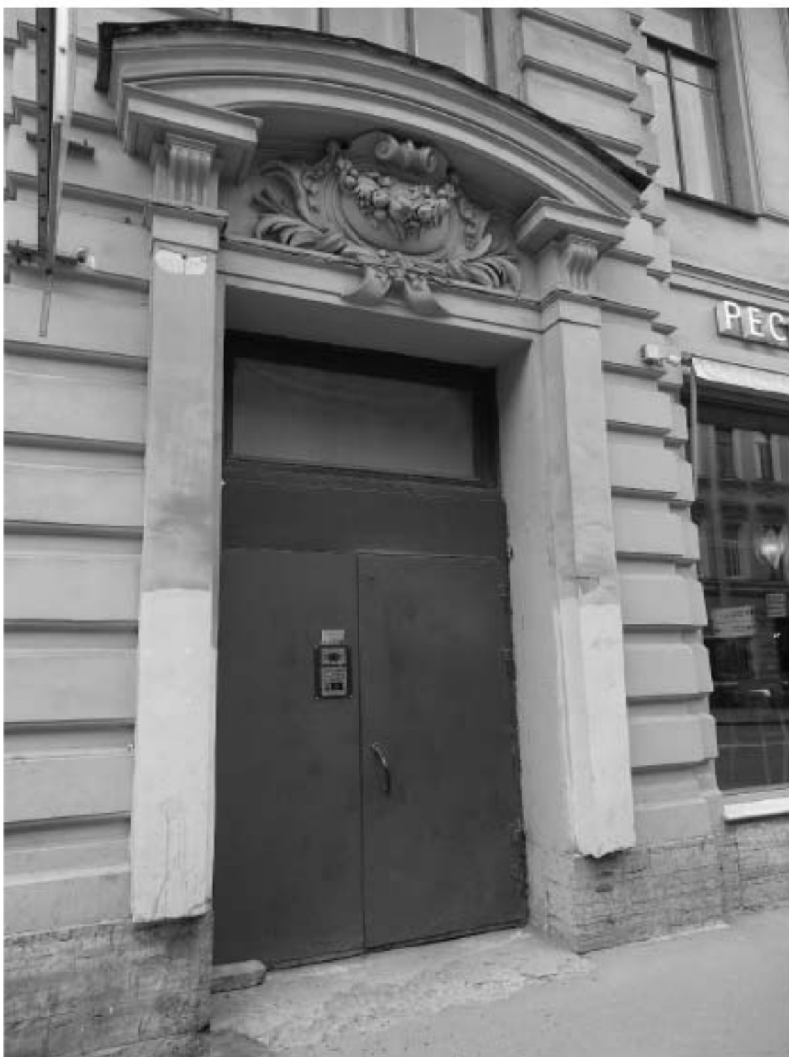
Фото 8. Здание по адресу: г. Санкт-Петербург, Большой проспект П.С., дом 49/18, литера А. Лицевой фасад по ул. Ленина. Центральная парадная. Съемка 19.04.2021 г. Михайловская Г. В.
