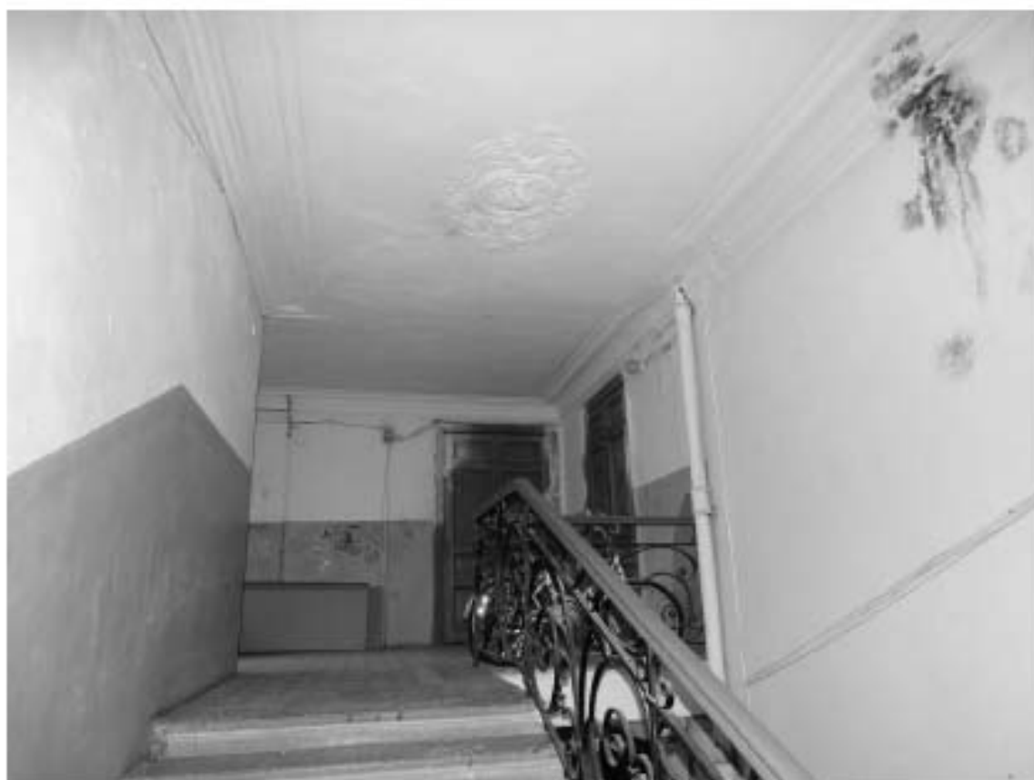
Фото 83. 1ЛК. 5-й этаж. Съемка 19.04.2021 г. Михайловская Г. В.
