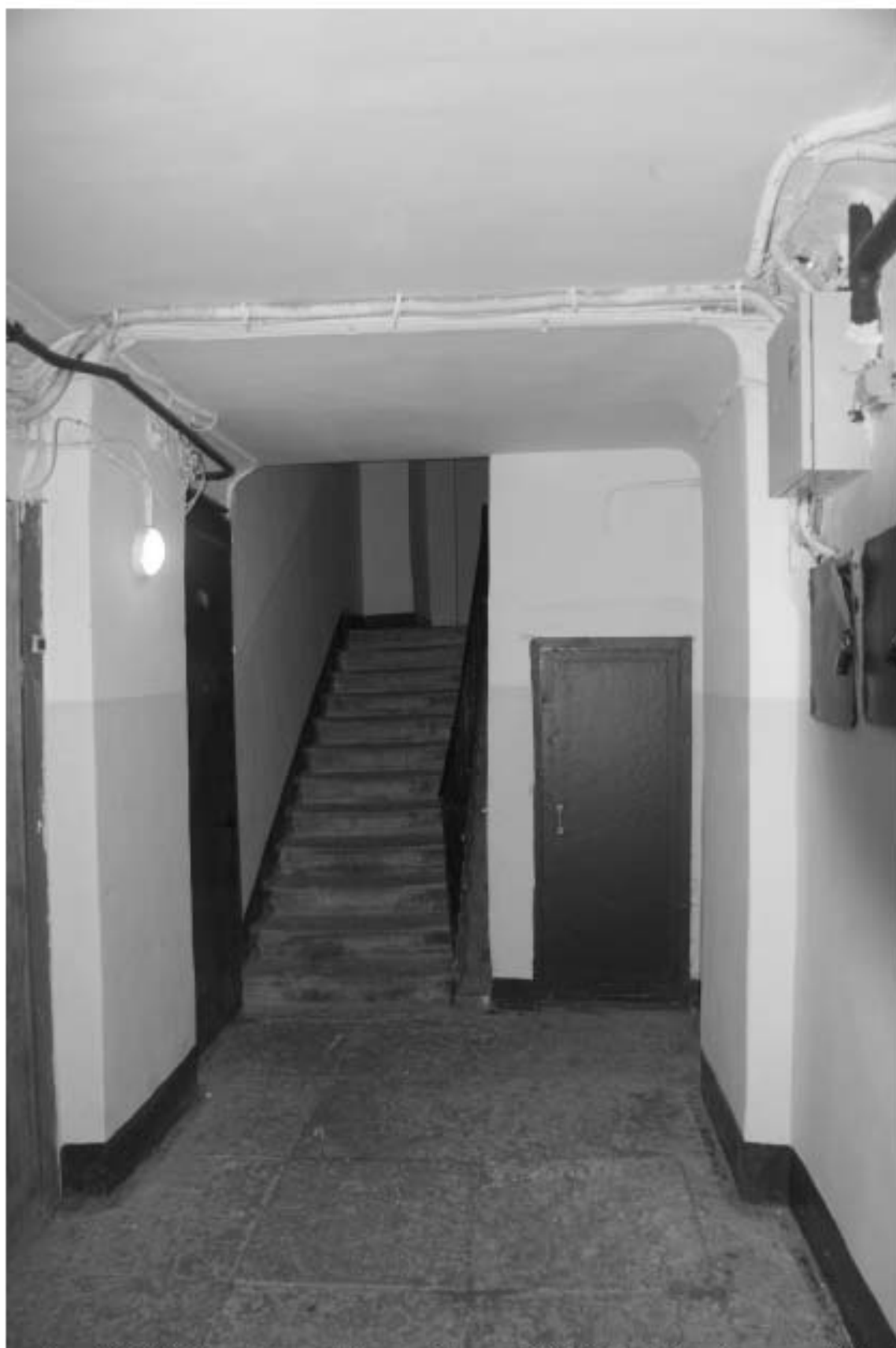
Фото 86. БЛК. Вестибюль. 1-й этаж. Съемка 19.04.2021 г. Михайловская Г. В.
