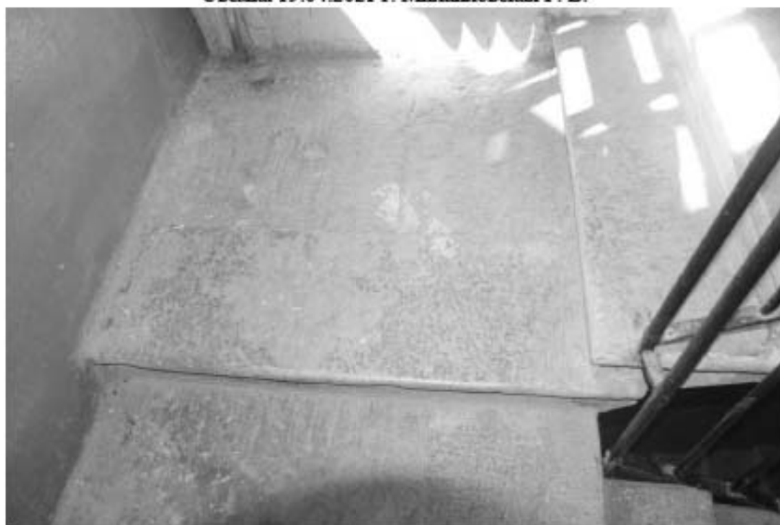
Фото 123. 5ЛК. Площадка между 3-м и 4-м этажом. Съемка 19.04.2021 г. Михайловская Г. В.
