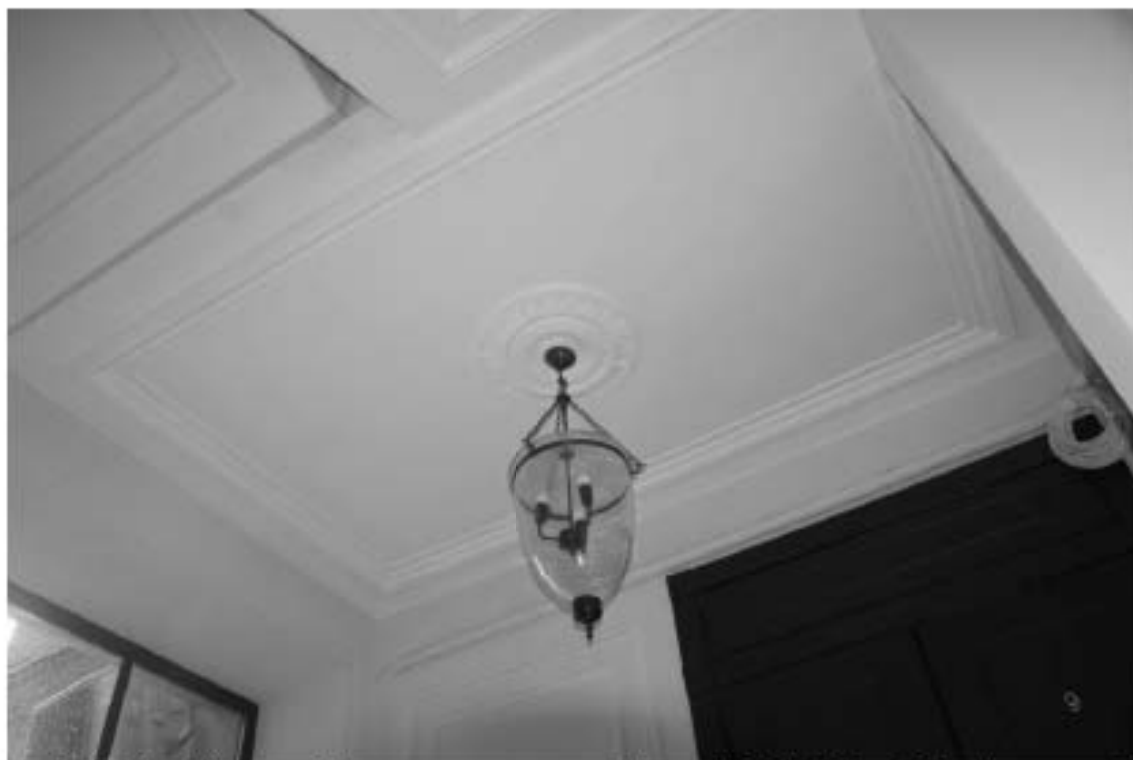
Фото 39. 4ЛК. 1-й этаж. Оформление потолка. Съемка 19.04.2021 г. Михайловская Г. В.
