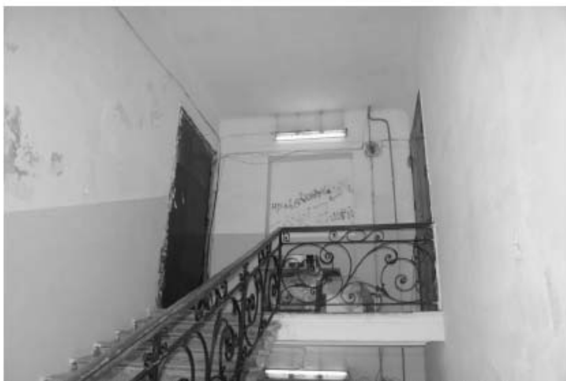
Фото 27. 2ЛК. 6-й этаж. Съемка 19.04.2021 г. Михайловская Г. В.
