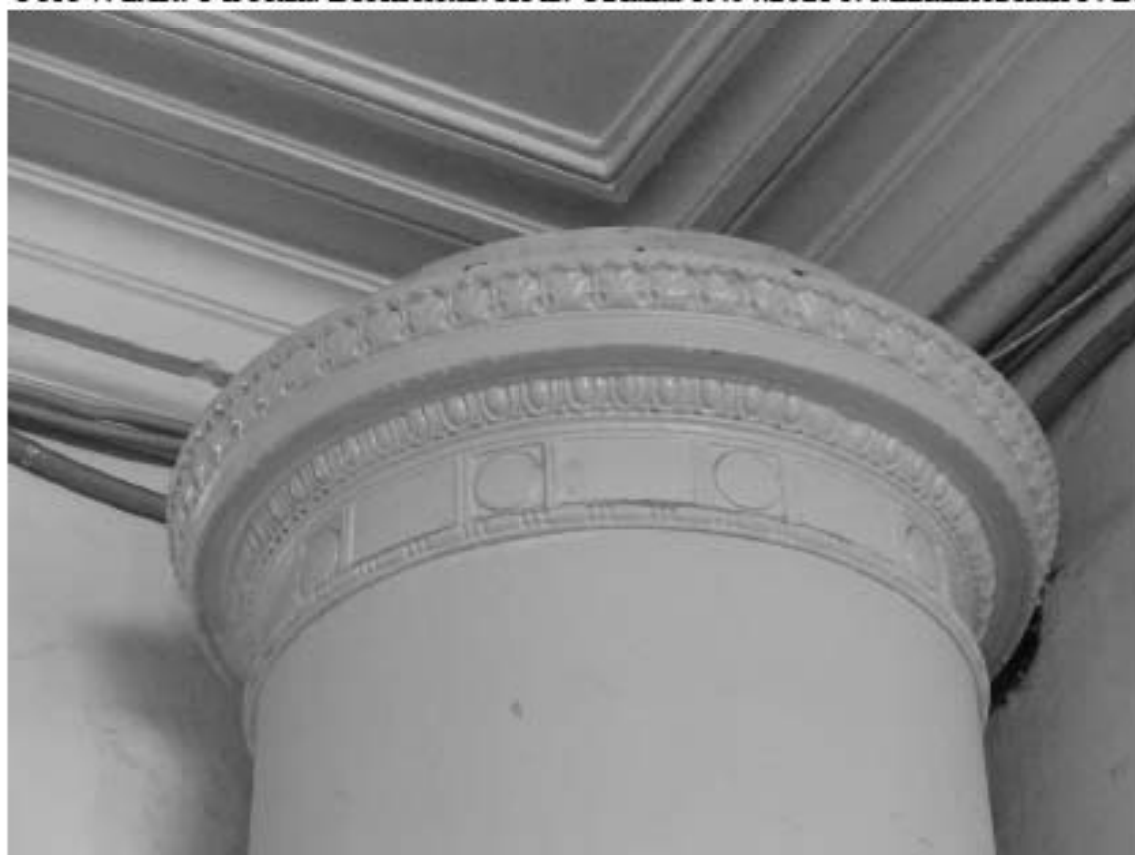
Фото 8. 2ЛК. 1-й этаж. Вестибюль. Фрагмент печи. Съемка 19.04.2021 г. Михайловская Г. В.
