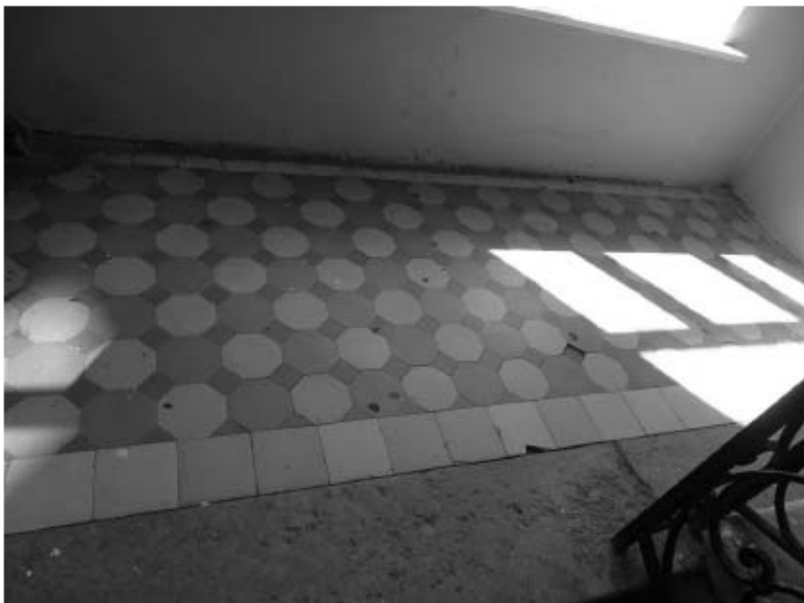
Фото 15. 2ЛК. Площадка между 1-м и 2-м этажом. Покрытие пола. Съемка 19.04.2021 г. Михайловская Г. В.
