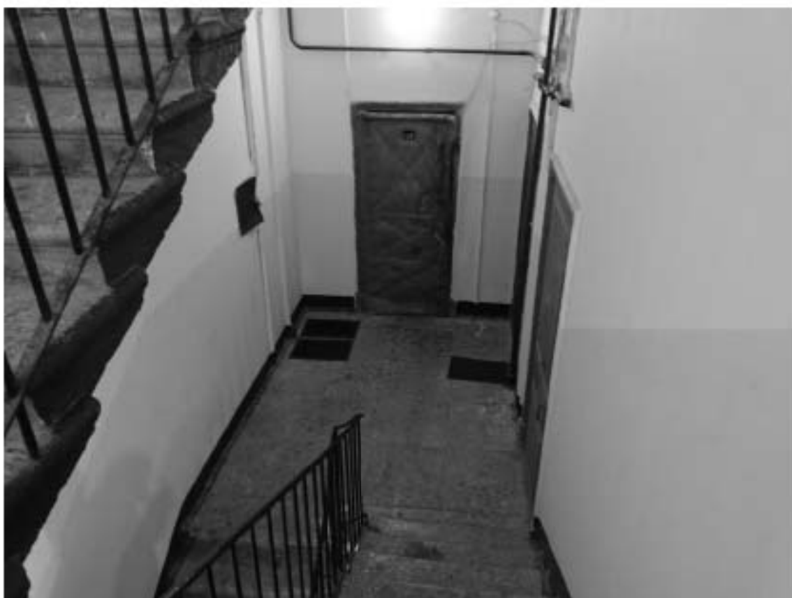
Фото 95. 6ЛК. Площадка 3-го этажа. Съемка 19.04.2021 г. Михайловская Г. В.
