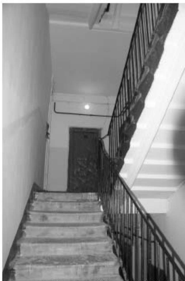
Фото 94. 6ЛК. Вид на площадку 3-го этажа. Съемка 19.04.2021 г. Михайловская Г. В.
