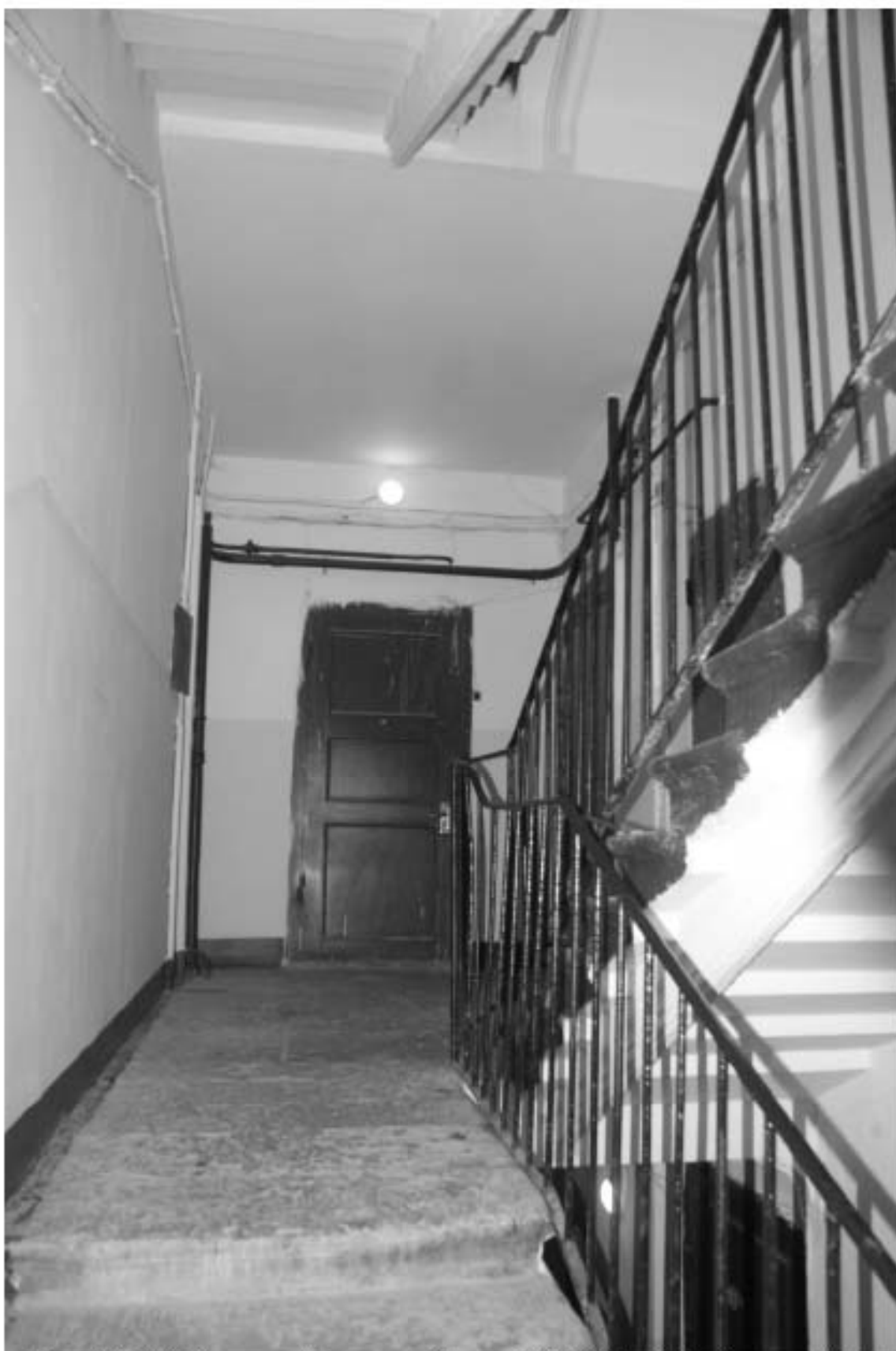
Фото 90. БЛК. Площадка 2-го этажа. Съемка 19.04.2021 г. Михайловская Г. В.
