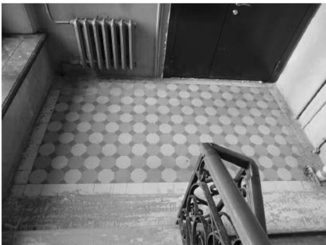
Фото 49. 4ЛК. 3-й этаж. Съемка 19.04.2021 г. Михайловская Г. В.
