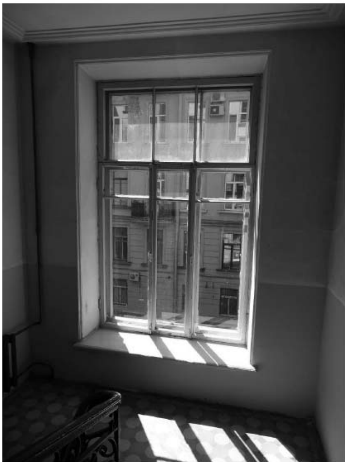
Фото 19. 2ЛК. Площадка между 2-м и 3-м этажом. Съемка 19.04.2021 г. Михайловская Г. В.
