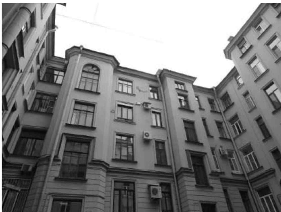
Фото 11. Здание по адресу: г. Санкт-Петербург, Большой проспект П.С., дом 49/18, литера А. Западный внутренний двор. Съемка 19.04.2021 г. Михайловская Г. В.
