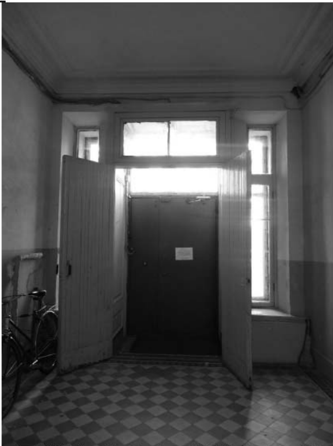
Фото 1. 2ЛК. 1-й этаж. Вестибюль. Съемка 19.04.2021 г. Михайловская Г. В.
