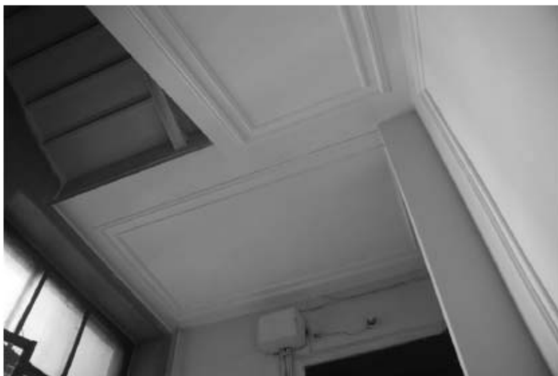
Фото 44. 4ЛК. 2-й этаж. Съемка 19.04.2021 г. Михайловская Г. В.
