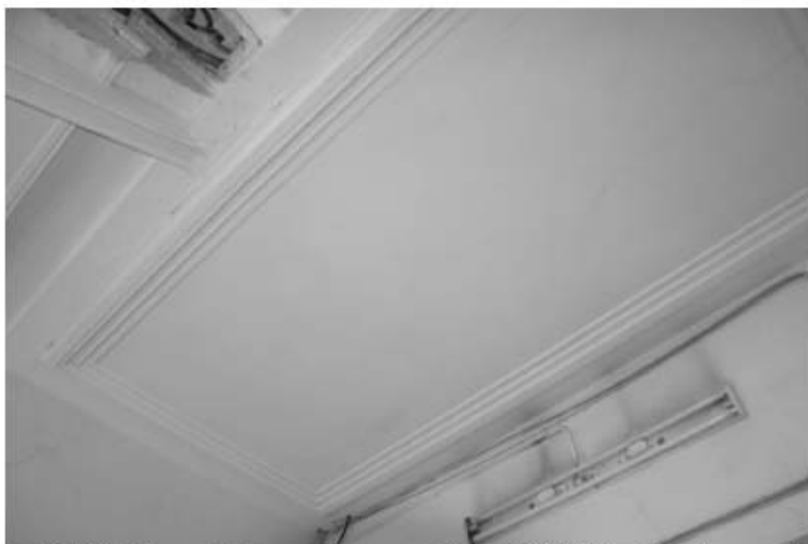
Фото 21. 2ЛК. 3-й этаж. Оформление потолка. Съемка 19.04.2021 г. Михайловская Г. В.
