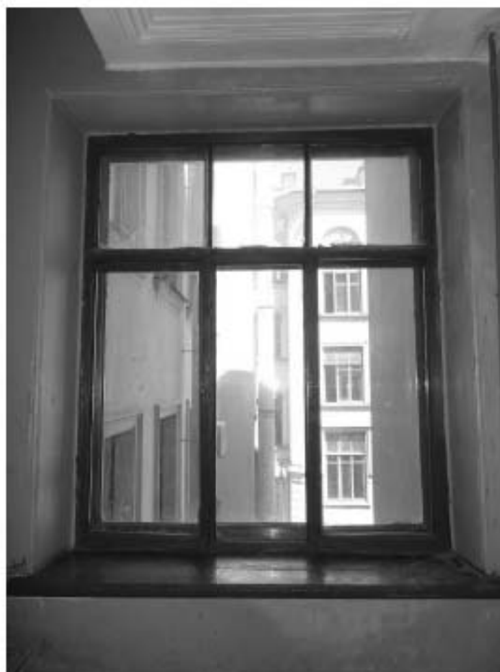
Фото 50. 4ЛК. 3-й этаж. Съемка 19.04.2021 г. Михайловская Г. В.
