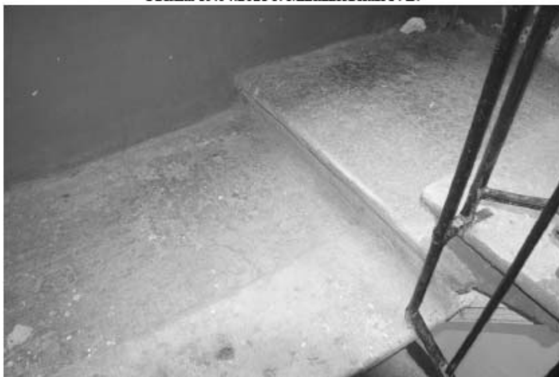
Фото 120. 5ЛК. Площадка между 1-м и 2-м этажом. Съемка 19.04.2021 г. Михайловская Г. В.
