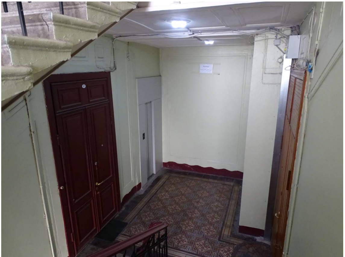
Фото 192. Лестница № 4. 4-й этаж. Съемка 19.04.2021 г. Трушковский В.Э.
