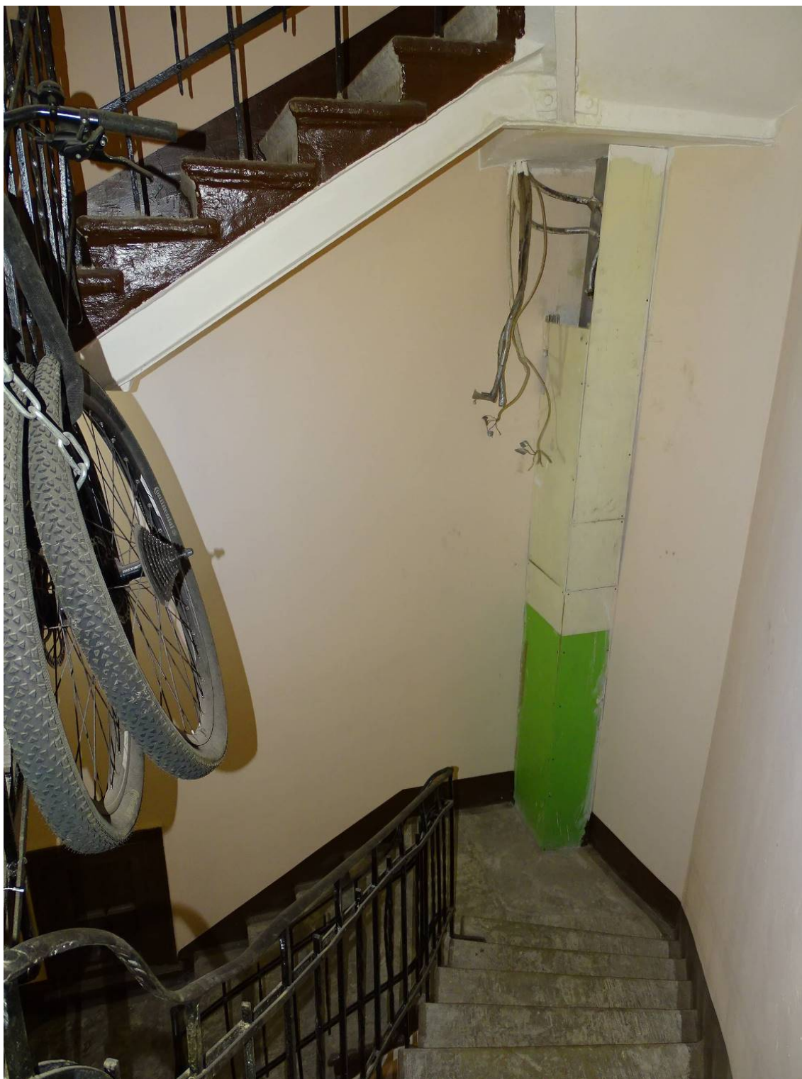
Фото 134. Лестница № 3. 5-й этаж. Съемка 19.04.2021 г. Трушковский В.Э.
