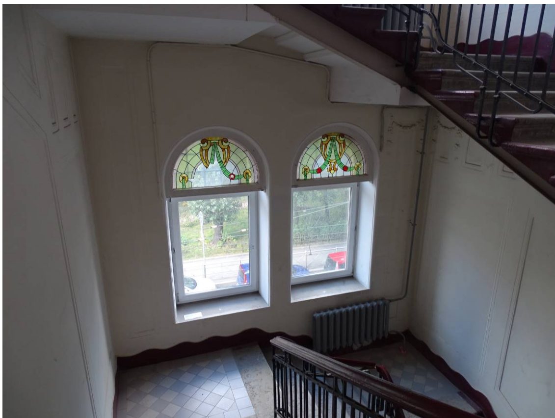
Фото 81. Лестница № 2. Площадка между 2-м и 3-м этажом. Съемка 19.04.2021 г. Трушковский В.Э.
