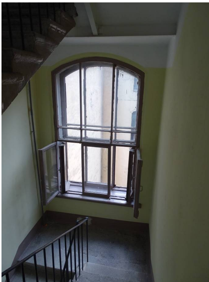
Фото 26. Лестница № 1. Площадка между 4-м и 5-м этажом. Съемка 19.04.2021 г. Трушковский В.Э.
