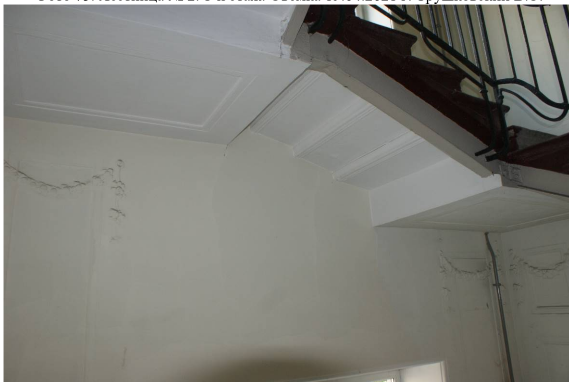
Фото 76. Лестница № 2. 1-й этаж. Оформление стен. Съемка 19.04.2021 г. Трушковский В.Э.
