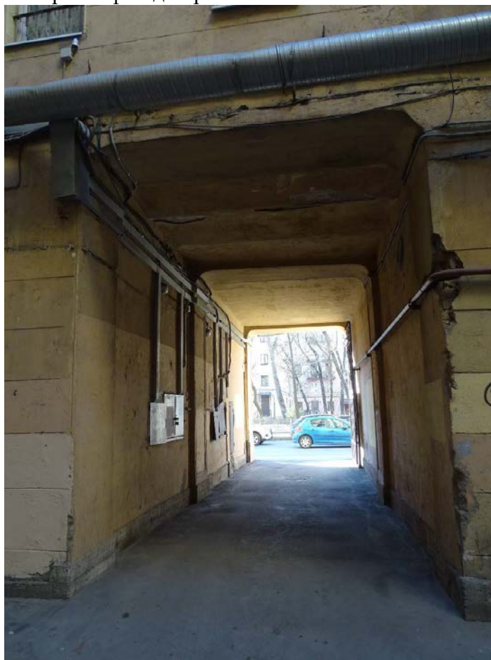
Фото 48. Здание по адресу: г. Санкт-Петербург, Большая Пушкарская ул., дом 1/8, литера А. Дворовой проезд. Съемка 19.04.2021 г. Трушковский В.Э.
