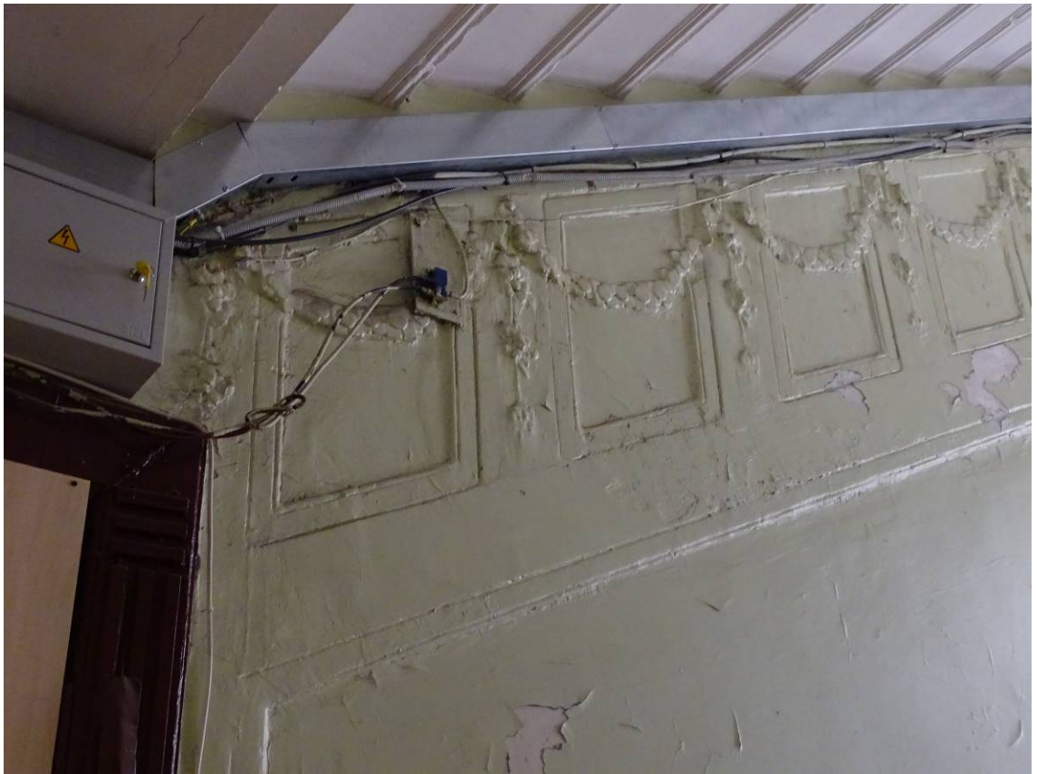
Фото 169. Лестница № 4. 1-й этаж. Парадная. Оформление стен. Съемка 19.04.2021 г. Трушковский В.Э.
