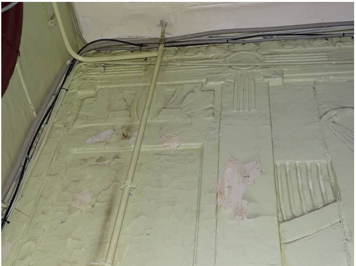
Фото 154. Лестница № 4. 1-й этаж. Парадная. Оформление стен. Съемка 19.04.2021 г. Трушковский В.Э.
