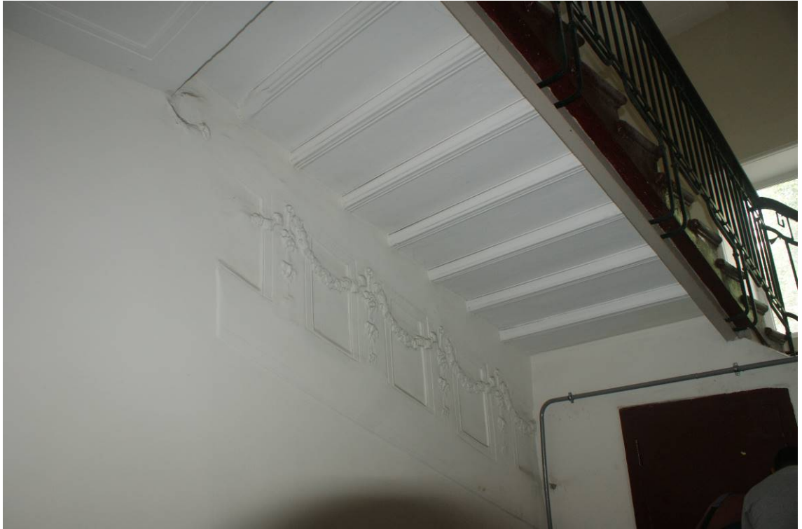
Фото 65. Лестница № 2. 1-й этаж. Парадная. Оформление стен. Съемка 19.04.2021 г. Трушковский В.Э.
