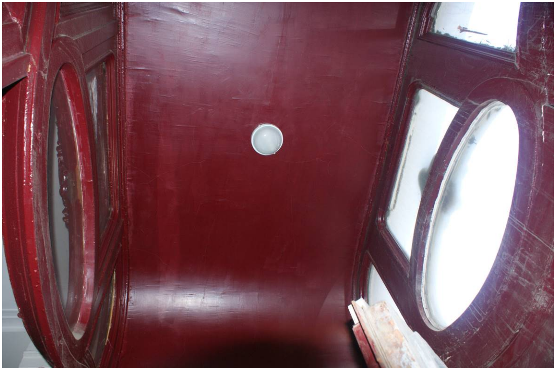
Фото 43. Лестница № 2. 1-й этаж. Входной тамбур. Съемка 19.04.2021 г. Трушковский В.Э.
