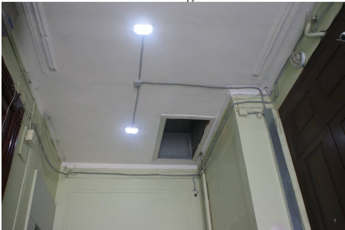
Фото 202. Лестница № 4. 6-й этаж. Выход на чердак. Съемка 19.04.2021 г. Трушковский В.Э.
