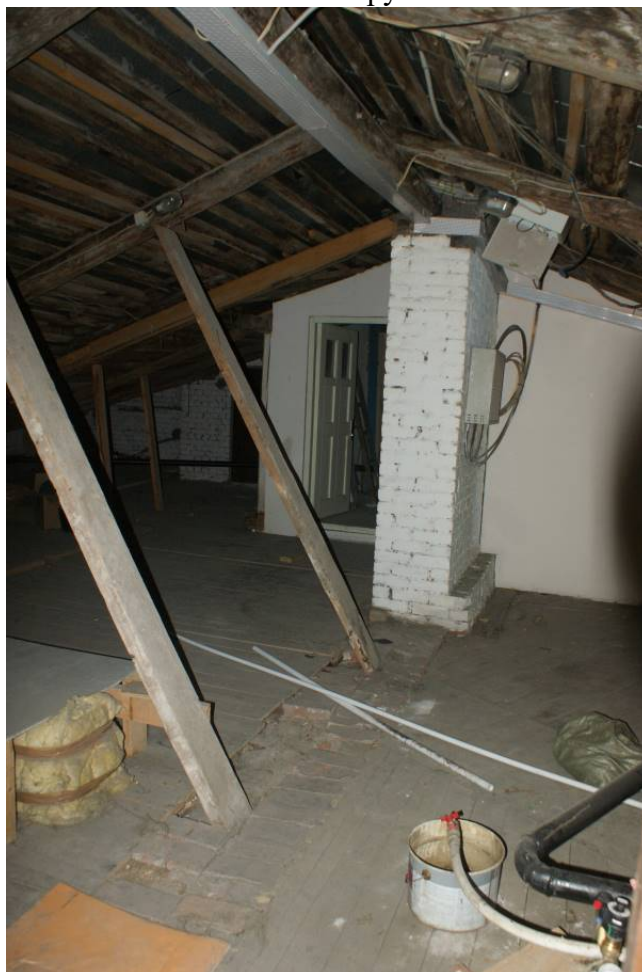
Фото 147. Лестница № 3. Чердак. Съемка 19.04.2021 г. Трушковский В.Э.
