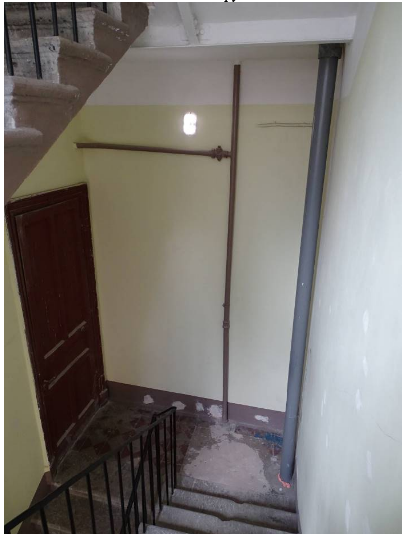
Фото 23. Лестница № 1. 4-й этаж. Съемка 19.04.2021 г. Трушковский В.Э.
