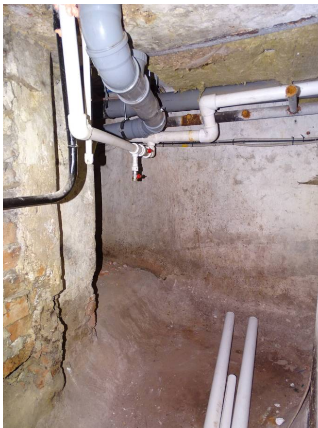
Фото 114. Лестница № 3. 1-й этаж. Подвал. Съемка 19.04.2021 г. Трушковский В.Э.
