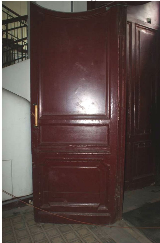
Фото 46. Лестница № 2. 1-й этаж. Заполнение дверного проема. Съемка 19.04.2021 г. Трушковский В.Э.
