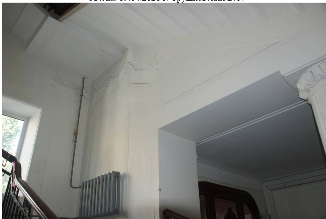
Фото 69. Лестница № 2. 1-й этаж. Парадная. Оформление стен. Съемка 19.04.2021 г. Трушковский В.Э.
