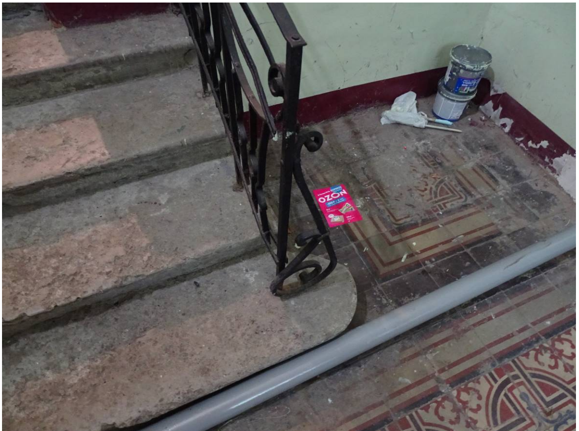
Фото 158. Лестница № 4. 1-й этаж. Парадная. Ступени. Съемка 19.04.2021 г. Трушковский В.Э.
