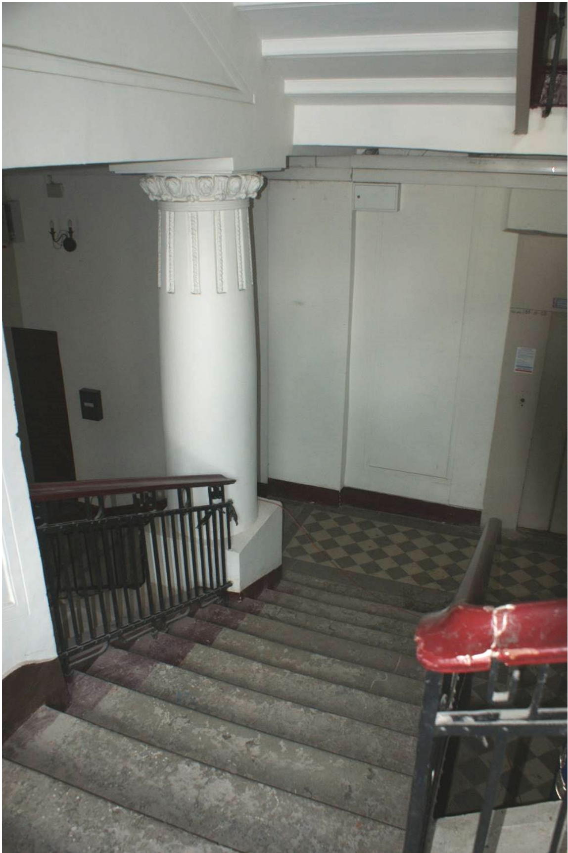
Фото 72. Лестница № 2. 1-й этаж. Парадная. Съемка 19.04.2021 г. Трушковский В.Э.
