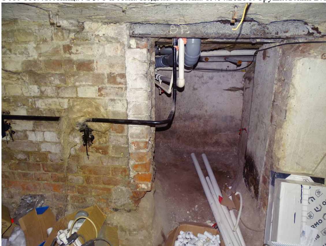
Фото 111. Лестница № 3. 1-й этаж. Подвал. Съемка 19.04.2021 г. Трушковский В.Э.
