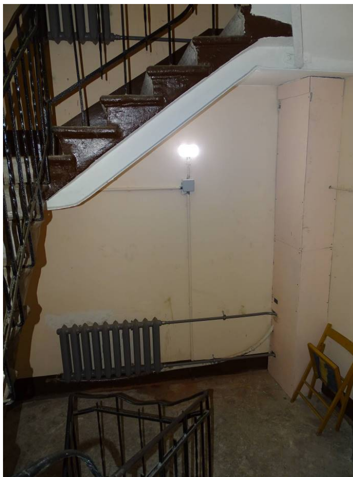
Фото 124. Лестница № 3. 2-й этаж. Съёмка 19.04.2021 г. Трушковский В.Э.
