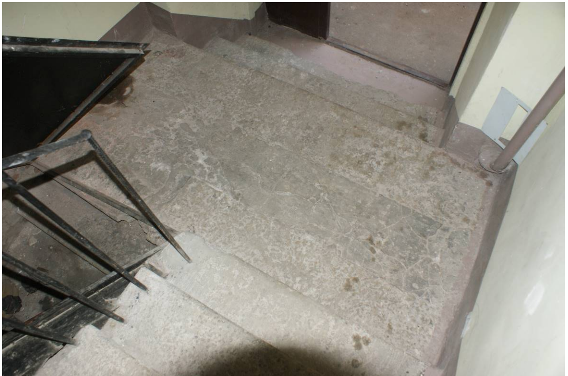
Фото 8. Лестница № 1. 1-й этаж. Съёмка 19.04.2021 г. Трушковский В.Э.
