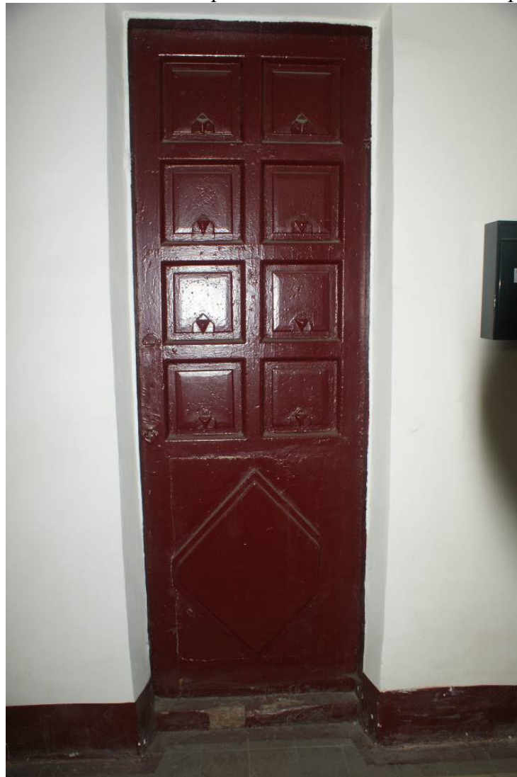
Фото 55. Лестница № 2. 1-й этаж. Парадная. Съемка 19.04.2021 г. Трушковский В.Э.
