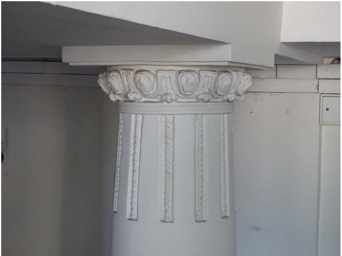
Фото 52. Лестница № 2. 1-й этаж. Парадная. Оформление колонны. Съемка 19.04.2021 г. Трушковский В.Э.
