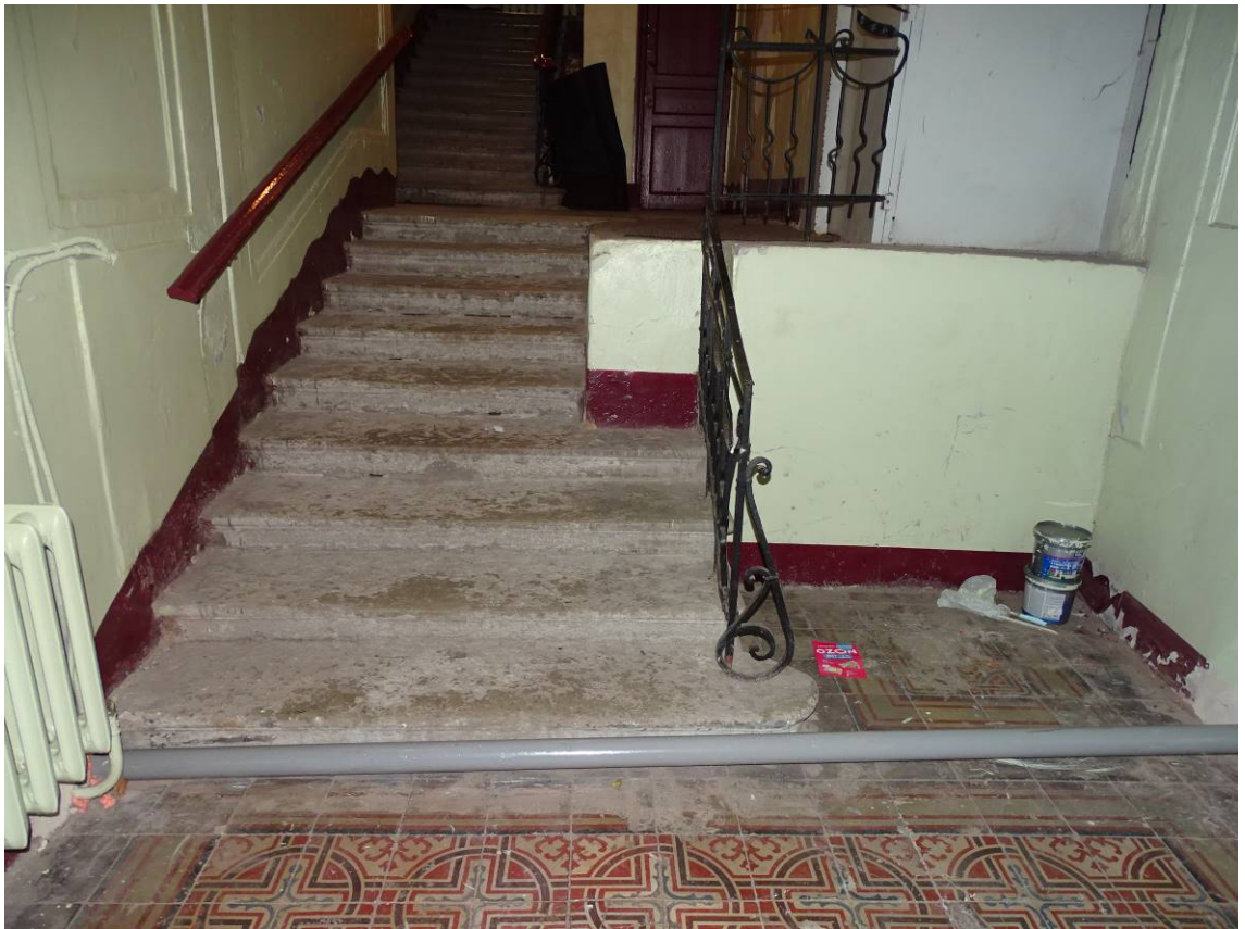
Фото 157. Лестница № 4. 1-й этаж. Парадная. Съемка 19.04.2021 г. Трушковский В.Э.
