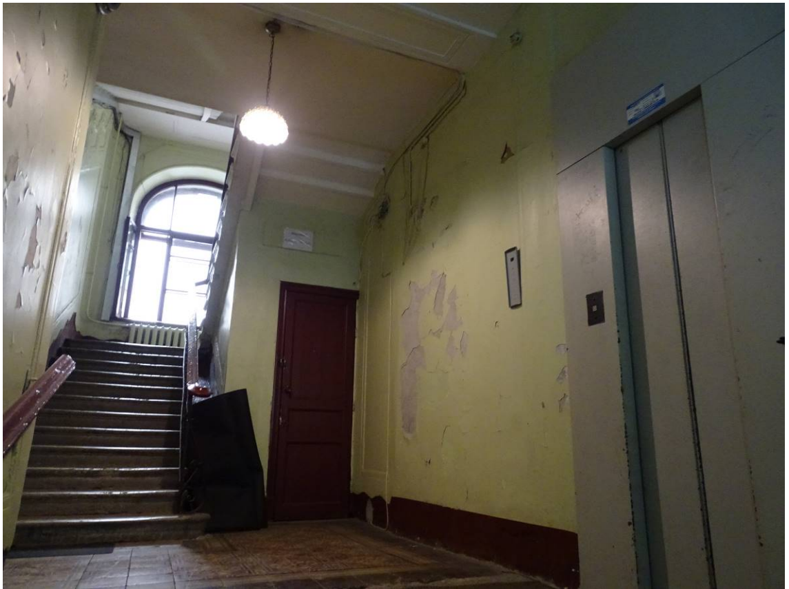
Фото 165. Лестница № 4. 1-й этаж. Парадная. Съемка 19.04.2021 г. Трушковский В.Э.
