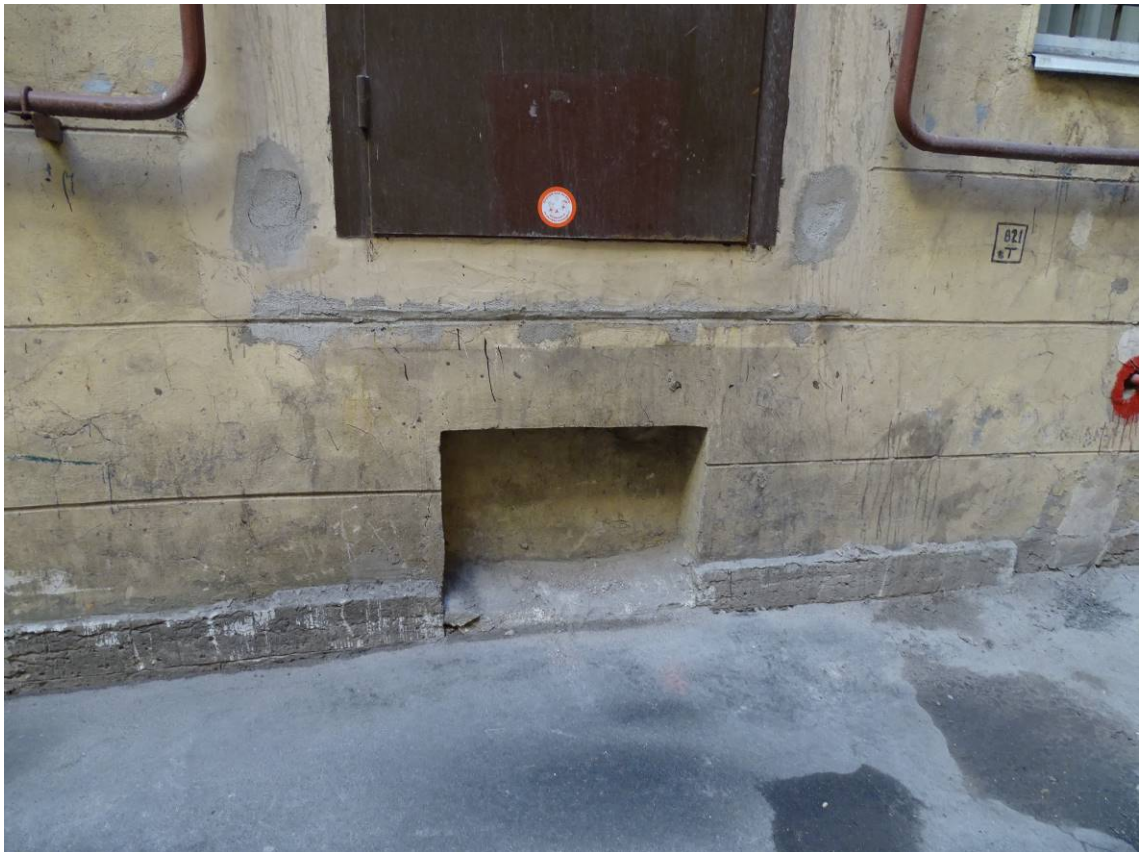
Фото 44. Здание по адресу: г. Санкт-Петербург, Большая Пушкарская ул., дом 1/8, литера А. Вид на Южный фасад. Фрагмент. Съемка 19.04.2021 г. Трушковский В.Э.
