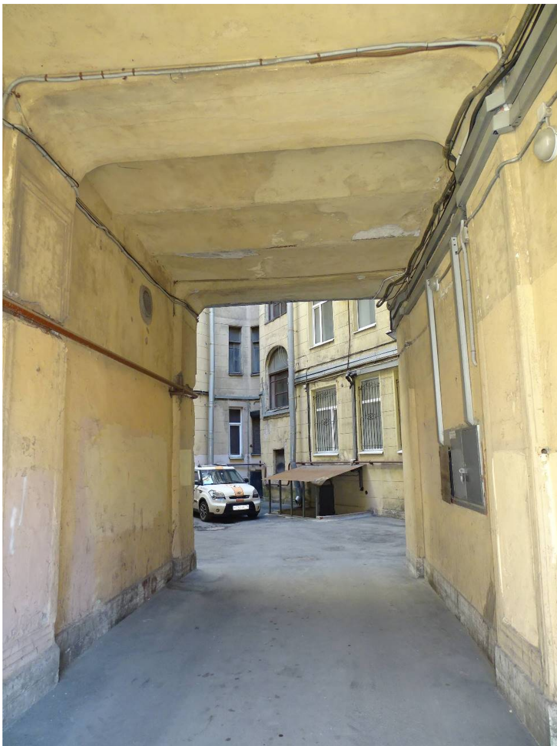
Фото 36. Здание по адресу: г. Санкт-Петербург, Большая Пушкарская ул., дом 1/8, литера А. Вид с Большой Пушкарской ул. Дворовой проезд. Съемка 19.04.2021 г. Трушковский В.Э.
