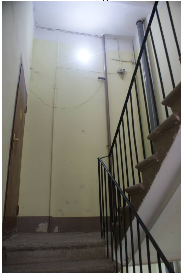
Фото 13. Лестница № 1. 2-й этаж. Съемка 19.04.2021 г. Трушковский В.Э.
