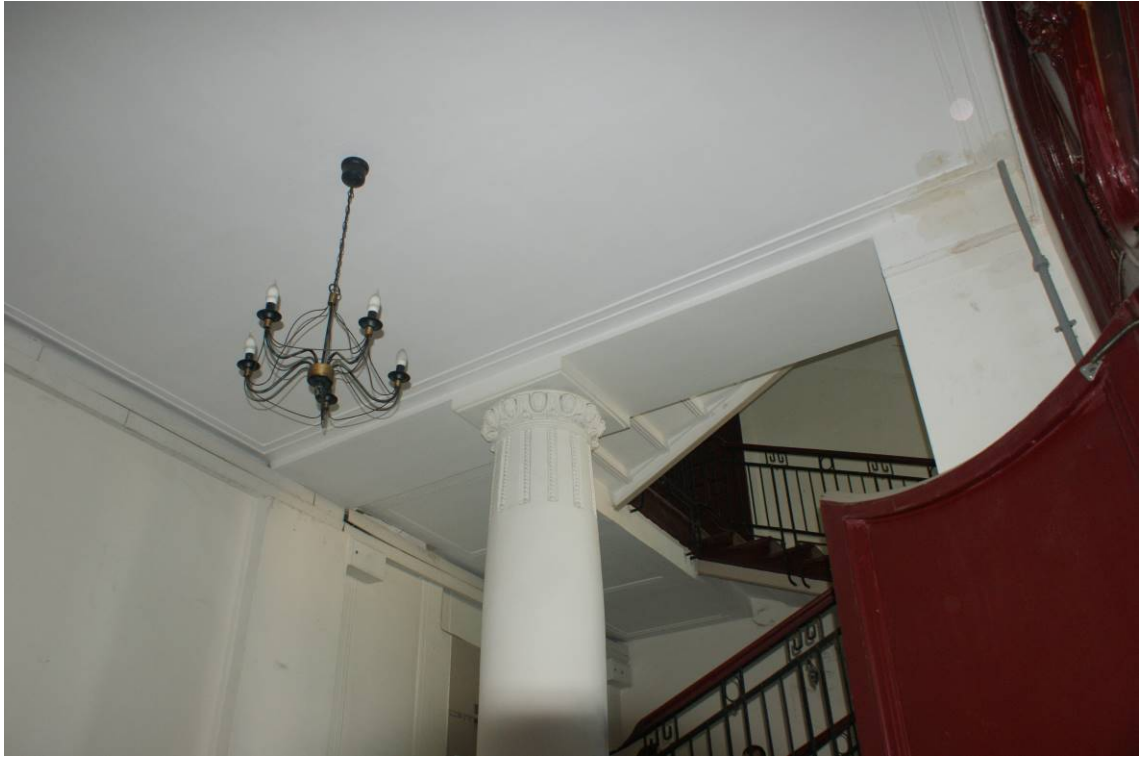
Фото 49. Лестница № 2. 1-й этаж. Парадная. Съемка 19.04.2021 г. Трушковский В.Э.
