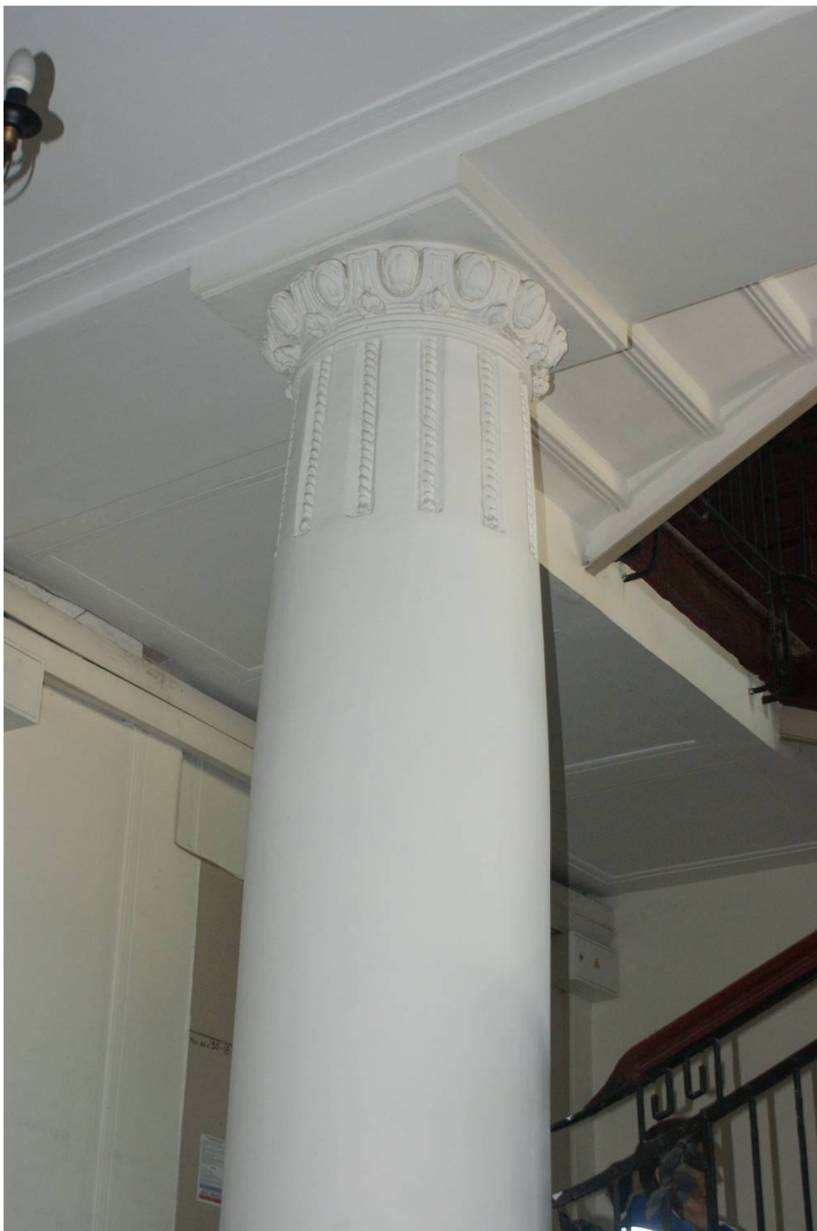
Фото 51. Лестница № 2. 1-й этаж. Парадная. Съемка 19.04.2021 г. Трушковский В.Э.
