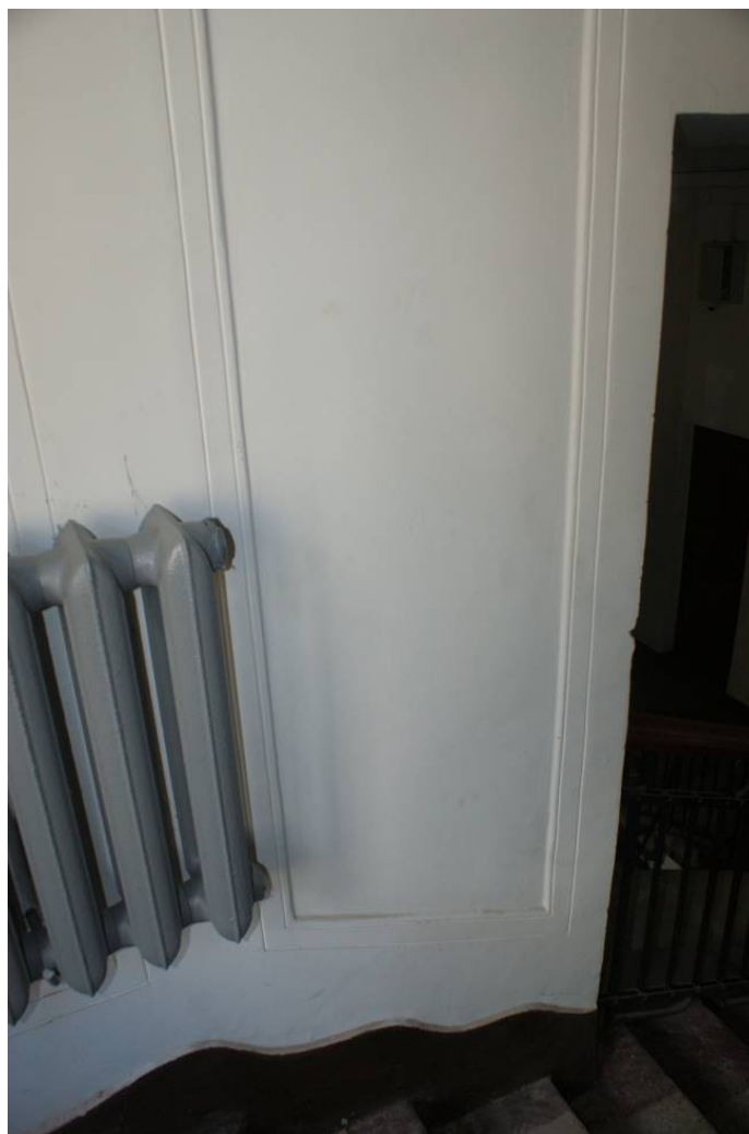
Фото 73. Лестница № 2. 1-й этаж. Оформление стен. Съемка 19.04.2021 г. Трушковский В.Э.
