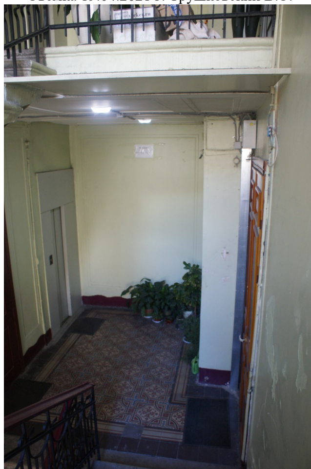
Фото 196. Лестница № 4. 5-й этаж. Съемка 19.04.2021 г. Трушковский В.Э.
