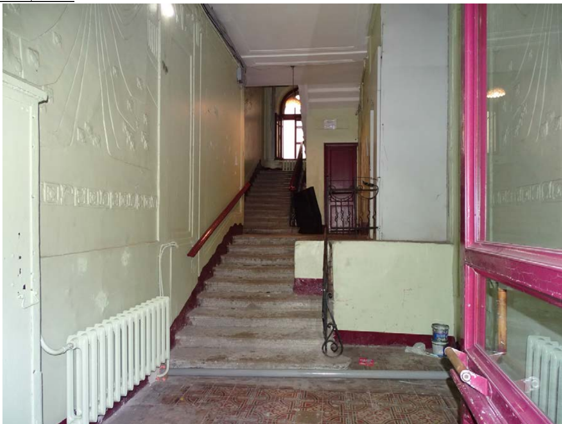
Фото 149. Лестница № 4. 1-й этаж. Парадная. Съемка 19.04.2021 г. Трушковский В.Э.
