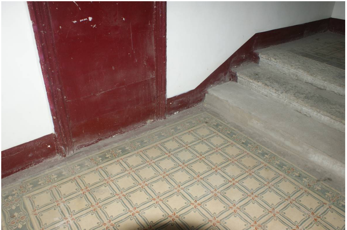
Фото 54. Лестница № 2. 1-й этаж. Парадная. Съемка 19.04.2021 г. Трушковский В.Э.
