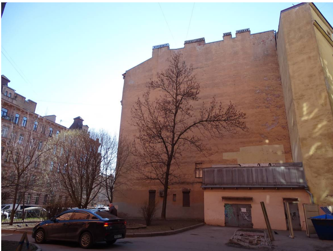
Фото 8. Здание по адресу: г. Санкт-Петербург, Большая Пушкарская ул., дом 1/8,литера А. Вид со двора. Съемка 19.04.2021 г. Трушковский В.Э.
