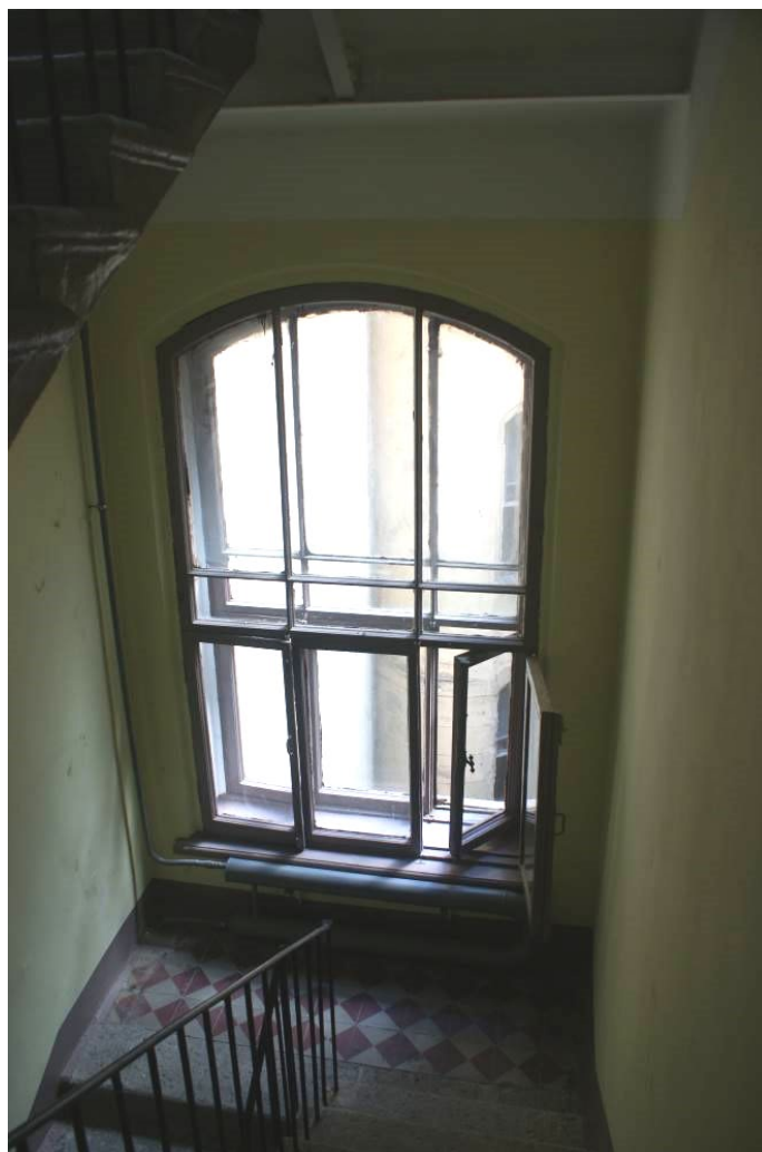
Фото 20. Лестница № 1. Площадка между 3-м и 4-м этажом. Съемка 19.04.2021 г. Трушковский В.Э.
