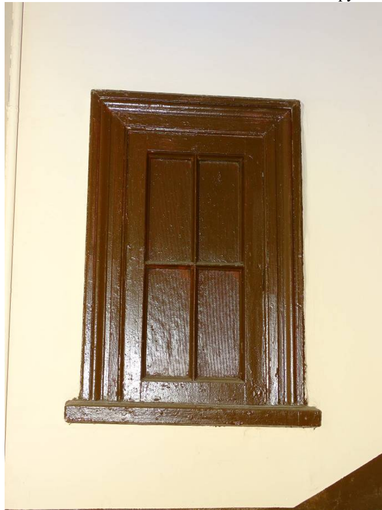
Фото 131. Лестница № 3. 4-й этаж. Съёмка 19.04.2021 г. Трушковский В.Э.
