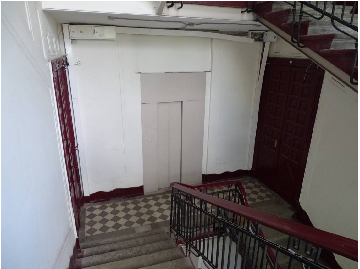
Фото 87. Лестница № 2. 3-й этаж. Съемка 19.04.2021 г. Трушковский В.Э.
