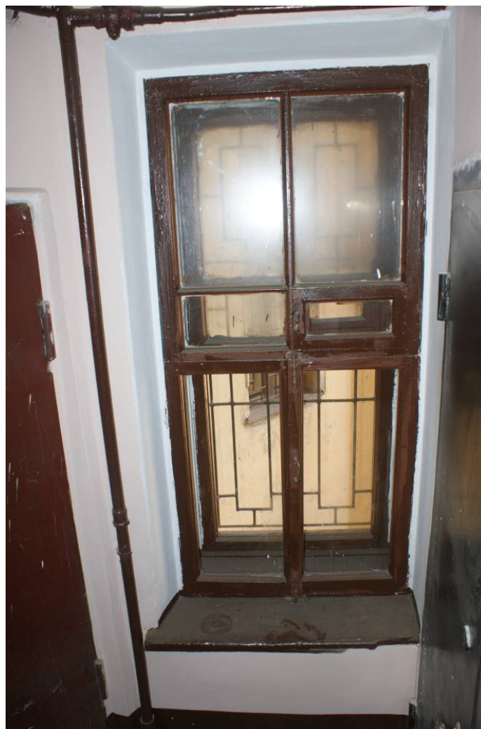
Фото 136. Лестница № 3. Площадка между 5-м и 6-м этажом. Съемка 19.04.2021 г. Трушковский В.Э.
