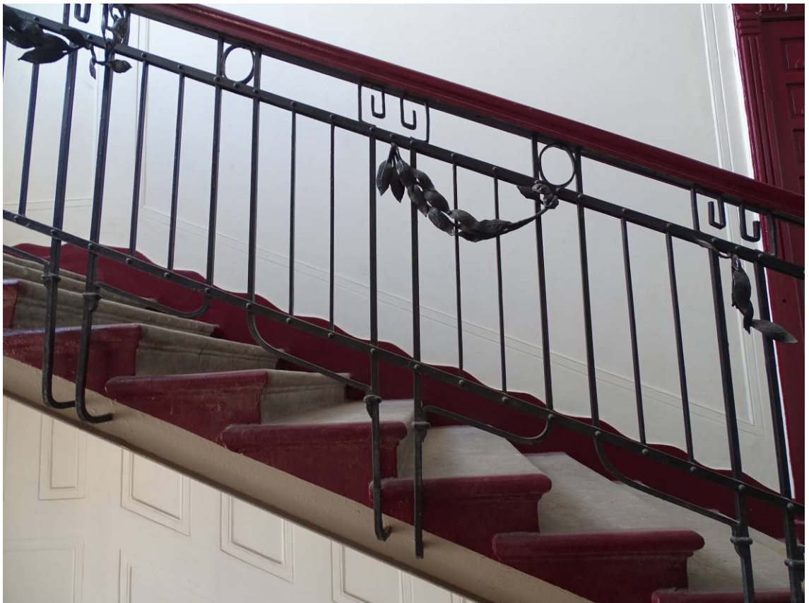
Фото 94. Лестница № 2. Фрагмент лестничного ограждения. Съемка 19.04.2021 г. Трушковский В.Э.
