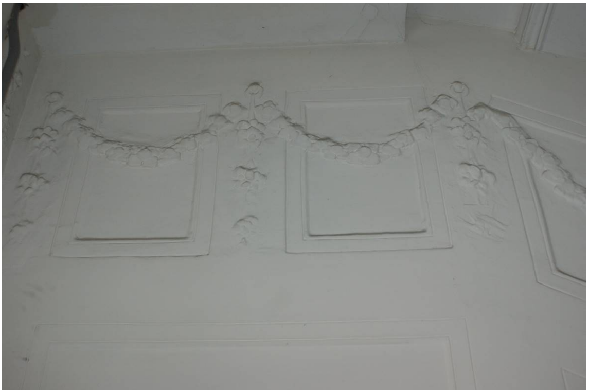
Фото 71. Лестница № 2. 1-й этаж. Парадная. Оформление стен. Съемка 19.04.2021 г. Трушковский В.Э.
