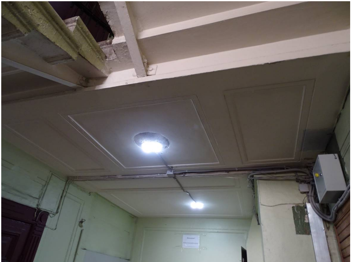
Фото 187. Лестница № 4. 3-й этаж. Оформление потолка. Съемка 19.04.2021 г. Трушковский В.Э.
