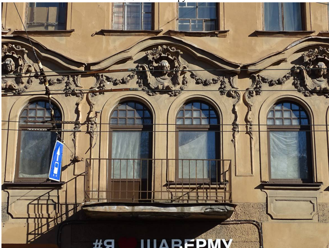
Фото 28. Здание по адресу: г. Санкт-Петербург, Большая Пушкарская ул., дом 1/8, литера А. Вид с Большой Пушкарской ул. Фрагмент. Съемка 19.04.2021 г. Трушковский В.Э.
