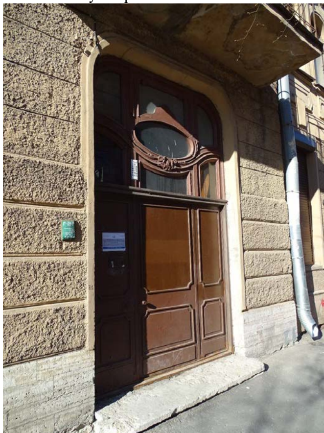
Фото 16. Здание по адресу: г. Санкт-Петербург, Большая Пушкарская ул., дом 1/8, литера А. Вид со Съезжинской ул. Фрагмент. Дверное заполнение. Съемка 19.04.2021 г. Трушковский В.Э.
