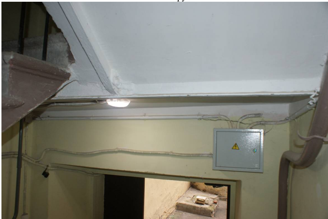
Фото 5. Лестница № 1. 1-й этаж. Вход в лестничную клетку. Съемка 19.04.2021 г. Трушковский В.Э.
