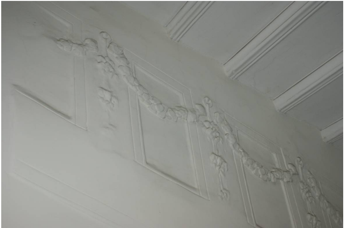
Фото 66. Лестница № 2. 1-й этаж. Парадная. Оформление стен. Съемка 19.04.2021 г. Трушковский В.Э.
