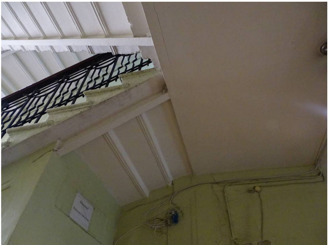
Фото 170. Лестница № 4. 1-й этаж. Парадная. Съемка 19.04.2021 г. Трушковский В.Э.
