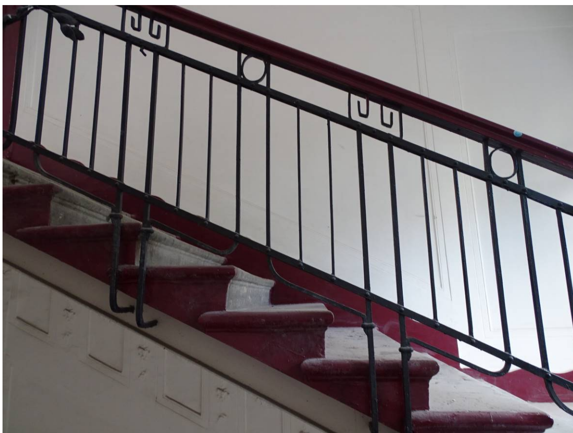
Фото 84. Лестница № 2. Фрагмент лестничного ограждения. Съемка 19.04.2021 г. Трушковский В.Э.
