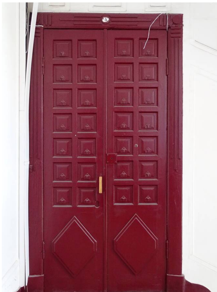
Фото 89. Лестница № 2. 3-й этаж. Съемка 19.04.2021 г. Трушковский В.Э.
