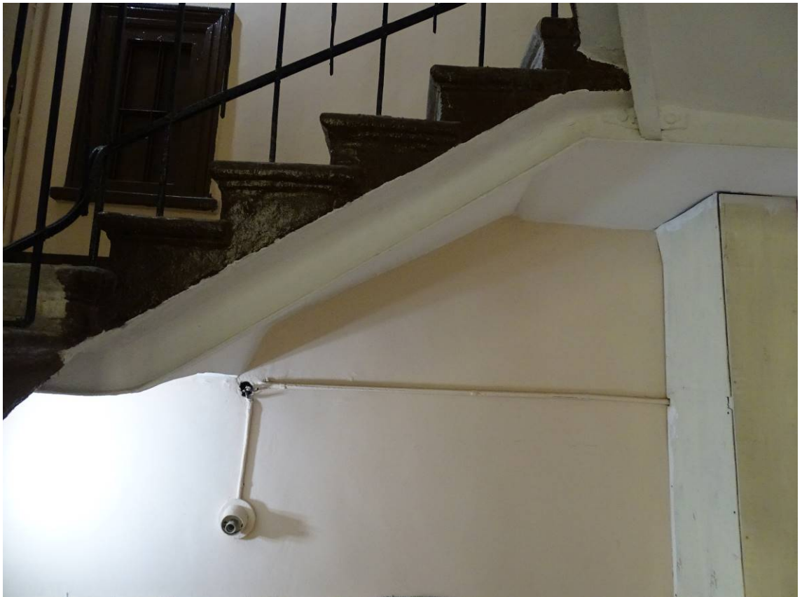
Фото 126. Лестница № 3. 3-й этаж. Съемка 19.04.2021 г. Трушковский В.Э.
