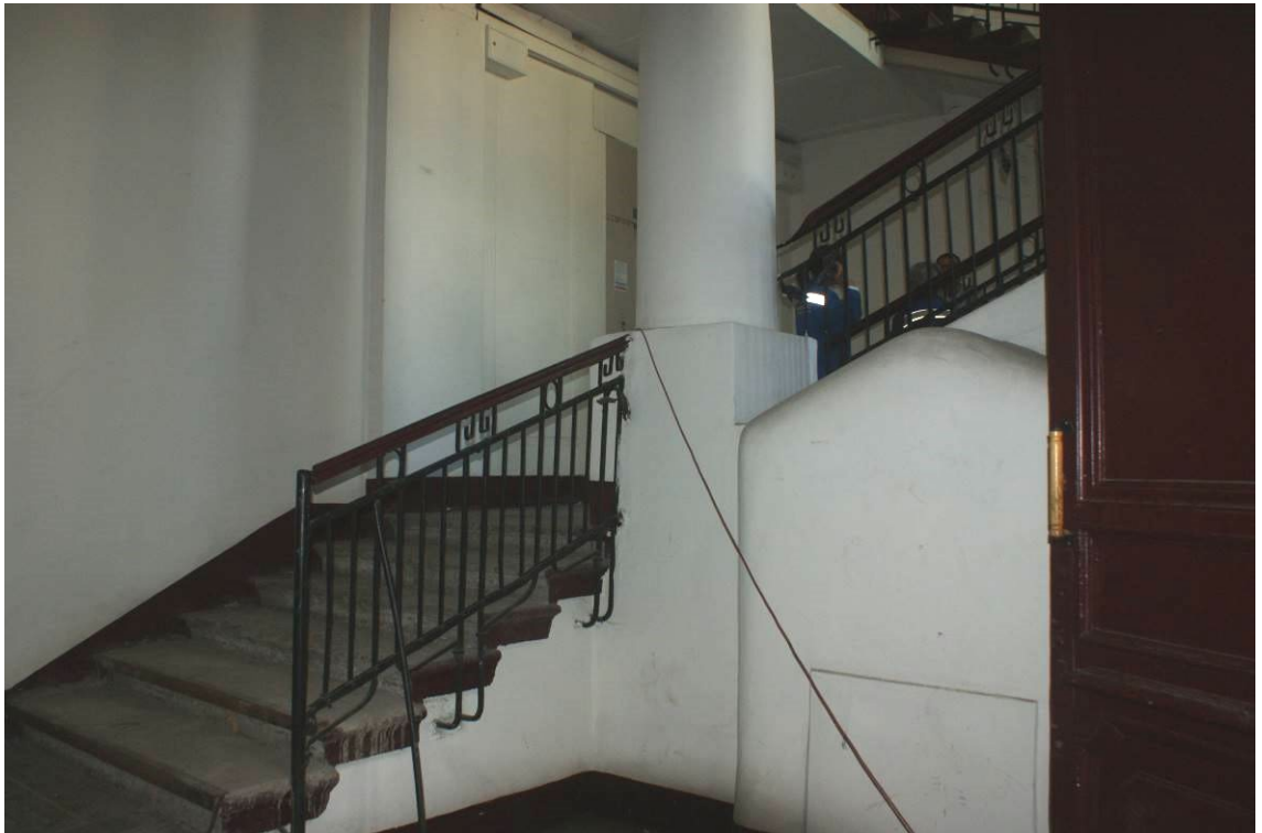
Фото 50. Лестница № 2. 1-й этаж. Парадная. Съемка 19.04.2021 г. Трушковский В.Э.
