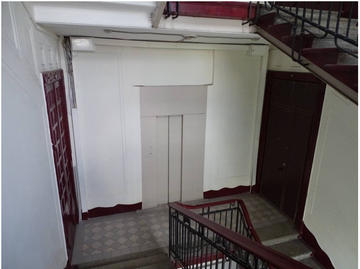
Фото 93. Лестница № 2. 4-й этаж. Съемка 19.04.2021 г. Трушковский В.Э.
