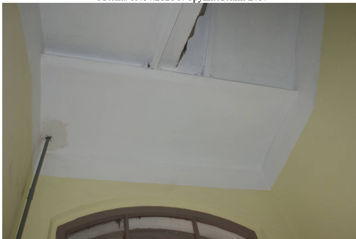
Фото 21. Лестница № 1. Площадка между 3-м и 4-м этажом. Съемка 19.04.2021 г. Трушковский В.Э.
