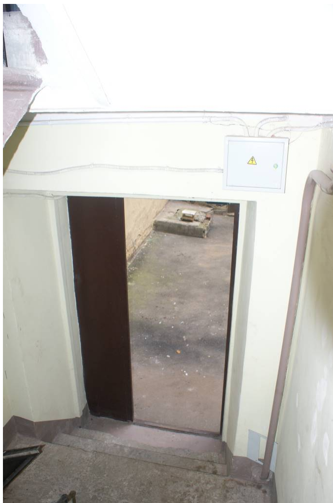
Фото 4. Лестница № 1. 1-й этаж. Вход в лестничную клетку. Съемка 19.04.2021 г. Трушковский В.Э.
