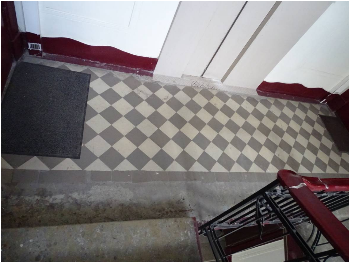
Фото 97. Лестница № 2. 5-й этаж. Покрытие пола. Съемка 19.04.2021 г. Трушковский В.Э.
