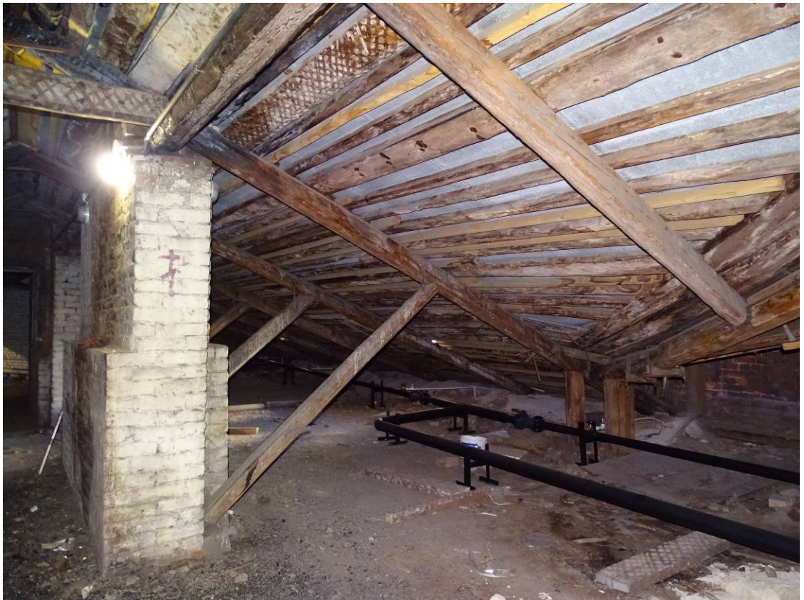
Фото 36. Лестница № 1. Чердачный этаж. Съемка 19.04.2021 г. Трушковский В.Э.
