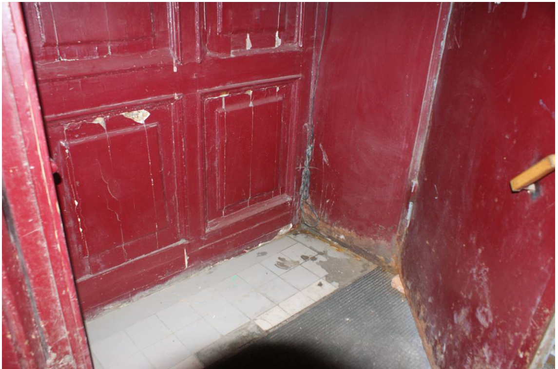
Фото 45. Лестница № 2. 1-й этаж. Входной тамбур. Съемка 19.04.2021 г. Трушковский В.Э.
