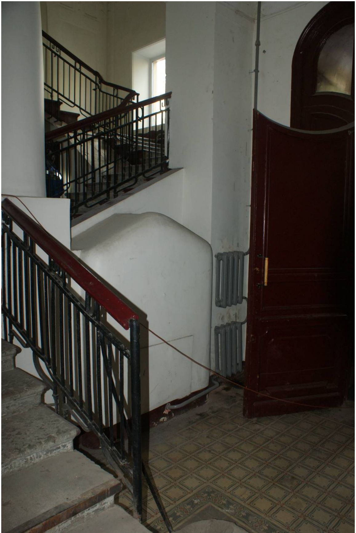
Фото 58. Лестница № 2. 1-й этаж. Парадная. Съемка 19.04.2021 г. Трушковский В.Э.
