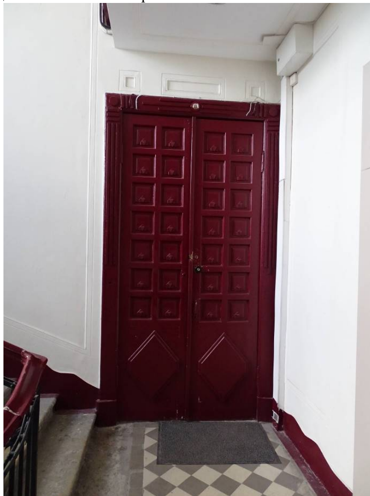
Фото 98. Лестница № 2. 5-й этаж. Съемка 19.04.2021 г. Трушковский В.Э.
