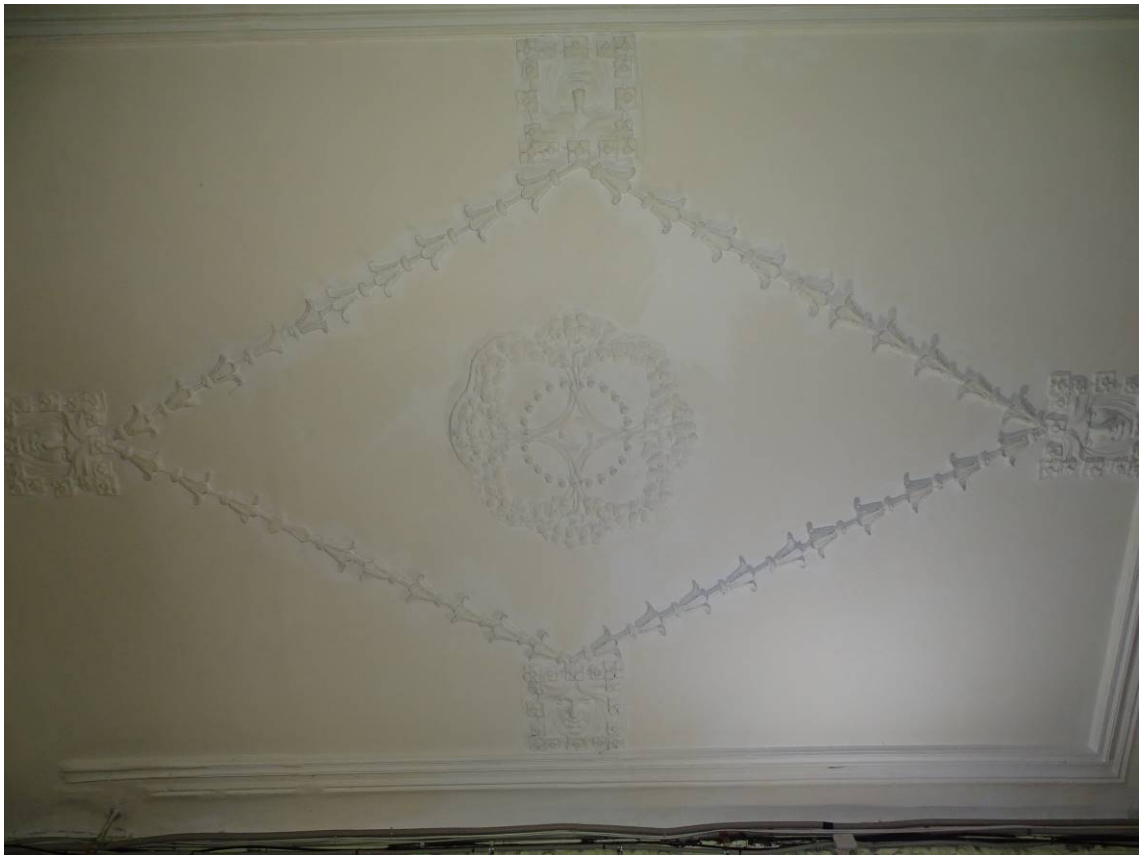
Фото 153. Лестница № 4. 1-й этаж. Парадная. Оформление потолка. Съемка 19.04.2021 г. Трушковский В.Э.
