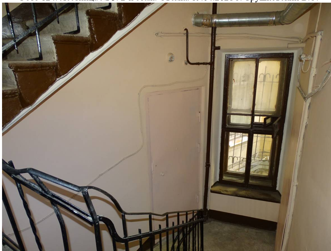
Фото 125. Лестница № 3. Площадка между 2-м и 3-м этажом. Съёмка 19.04.2021 г. Трушковский В.Э.
