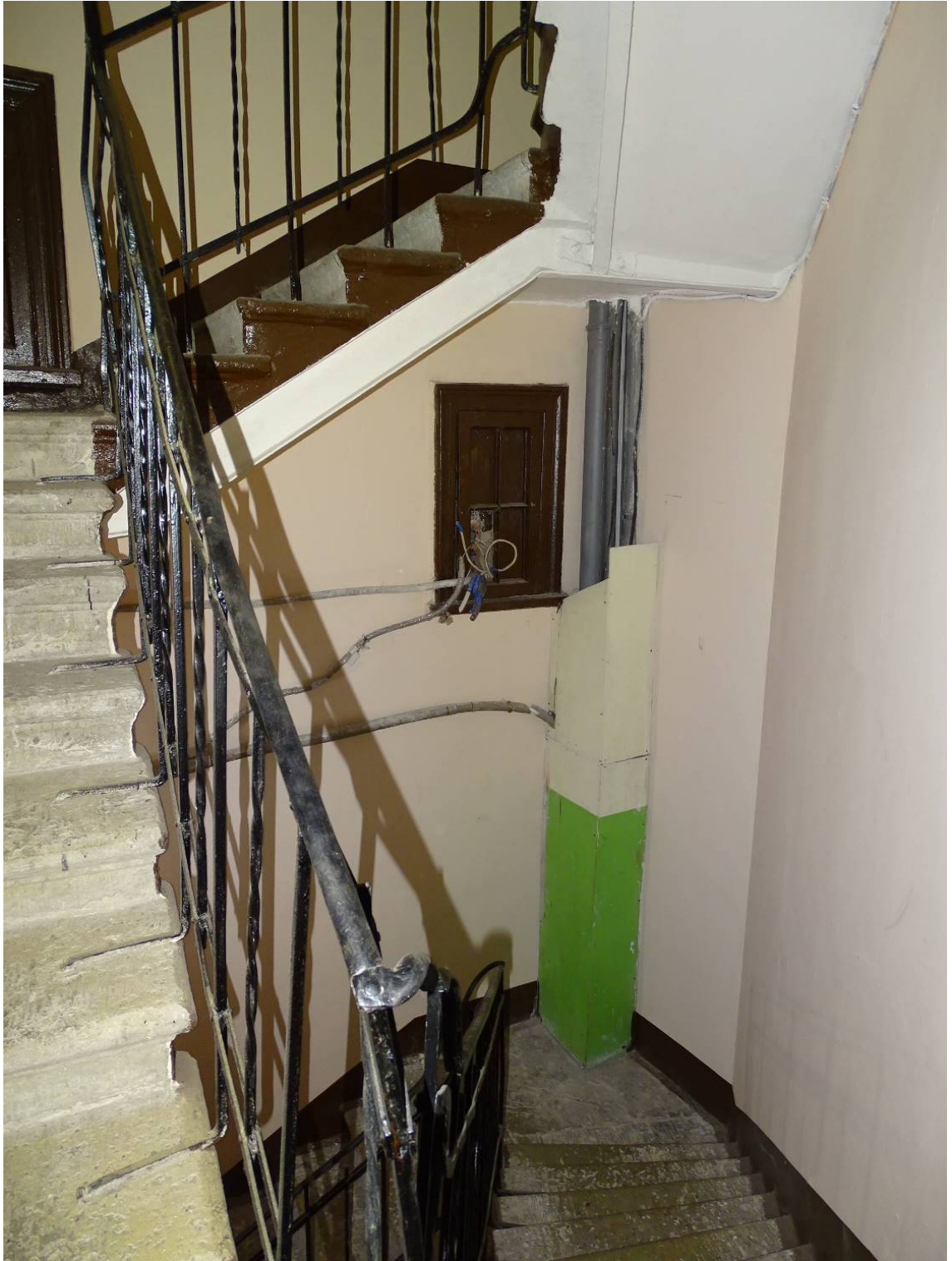
Фото 132. Лестница № 3. 4-й этаж. Съемка 19.04.2021 г. Трушковский В.Э.
