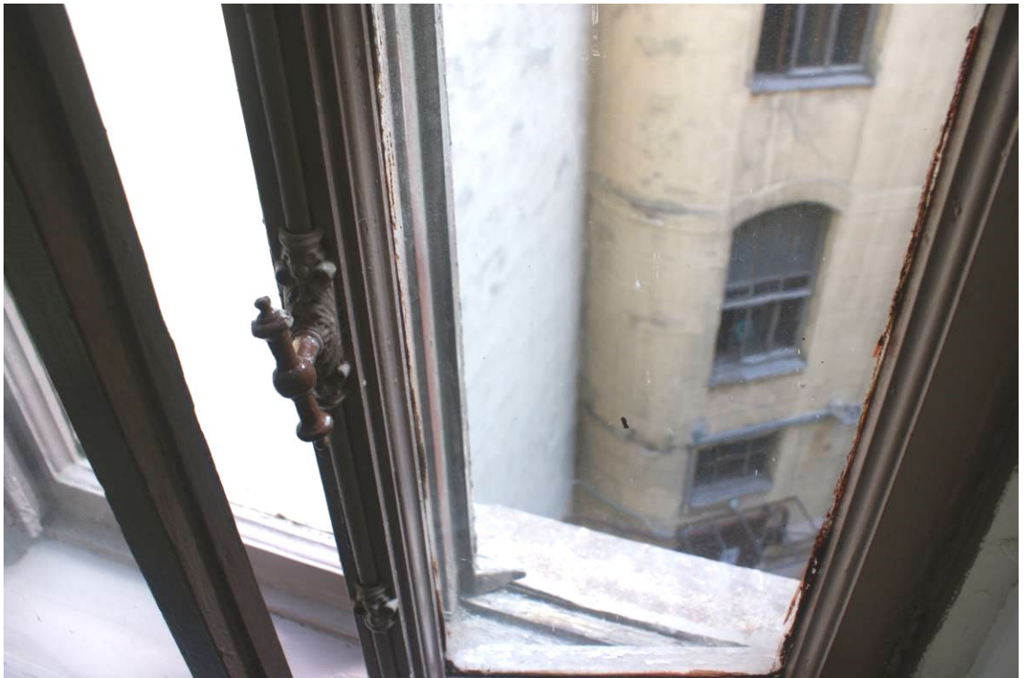
Фото 22. Лестница № 1. Площадка между 3-м и 4-м этажом. Оконная фурнитура. Съемка 19.04.2021 г. Трушковский В.Э.
