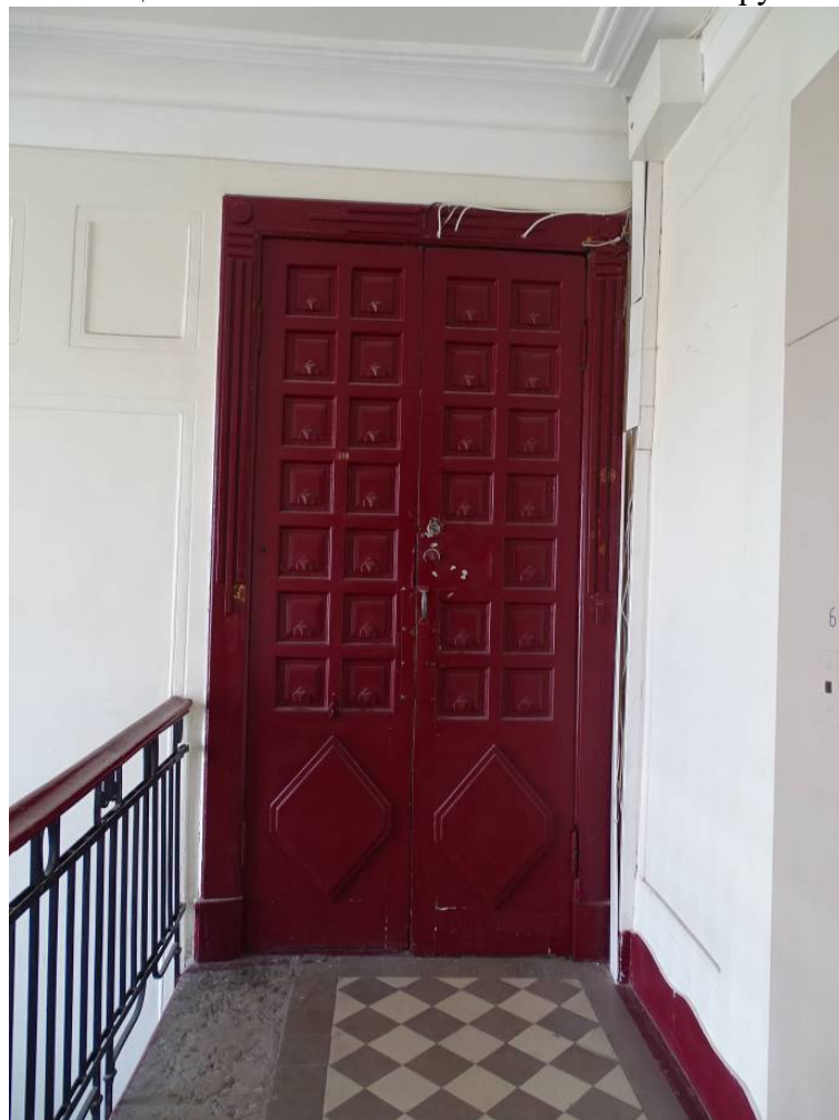
Фото 106. Лестница № 2. 6-й этаж. Съемка 19.04.2021 г. Трушковский В.Э.
