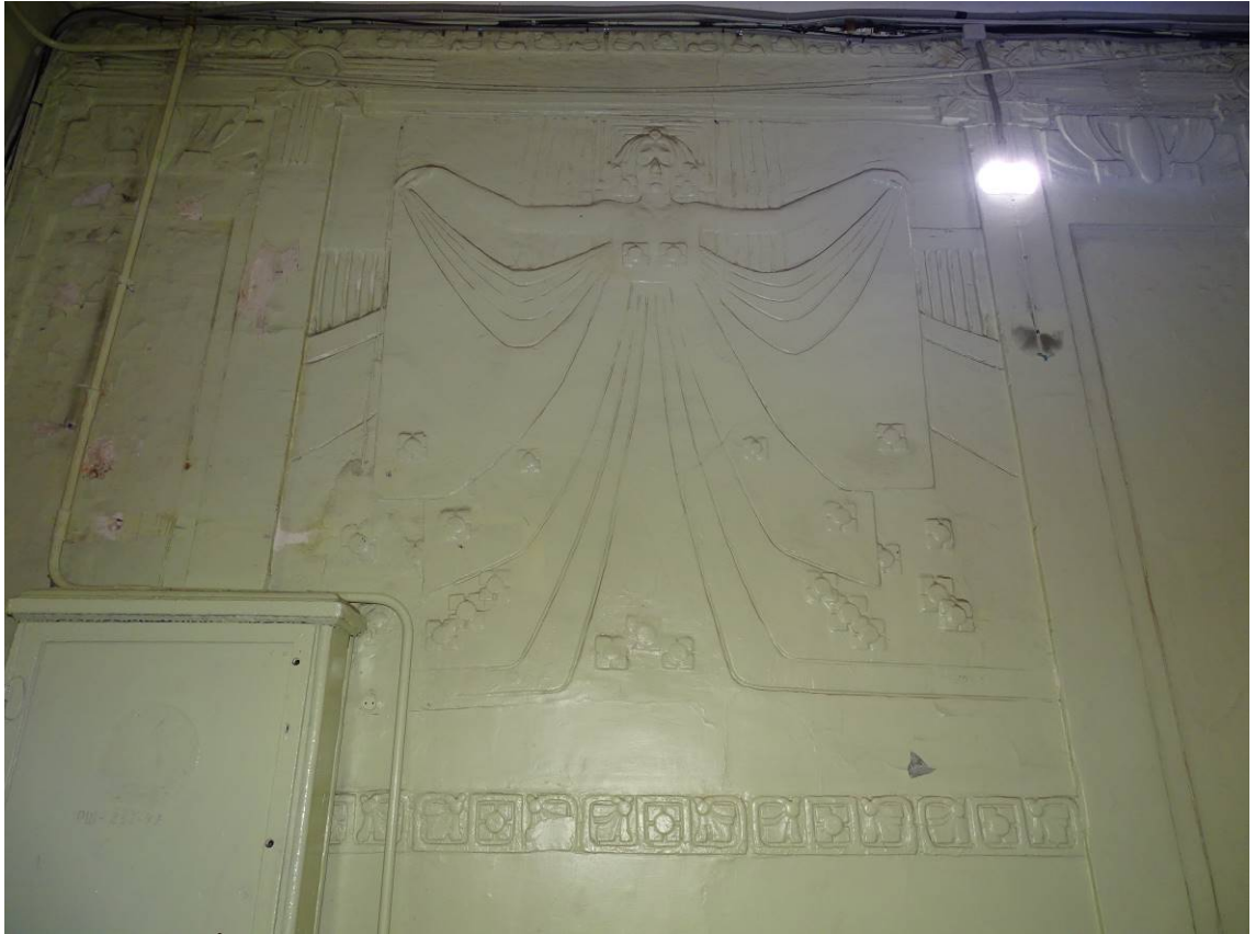
Фото 151. Лестница № 4. 1-й этаж. Парадная. Оформление стен. Съемка 19.04.2021 г. Трушковский В.Э.
