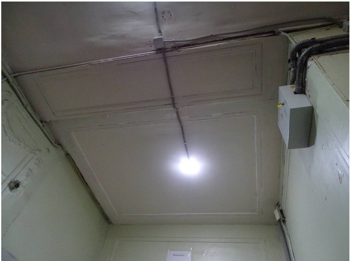
Фото 178. Лестница № 4. 2-й этаж. Оформление потолка. Съемка 19.04.2021 г. Трушковский В.Э.
