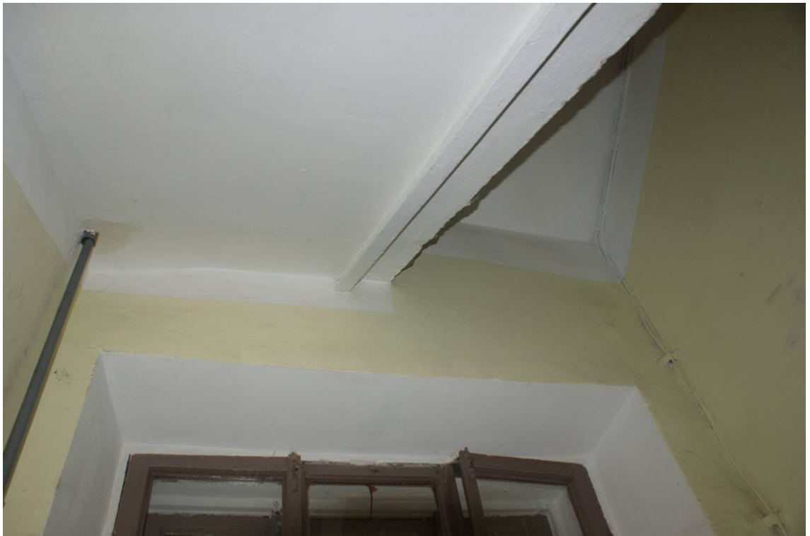
Фото 12. Лестница № 1. Площадка между 1-м и 2-м этажом. Съемка 19.04.2021 г. Трушковский В.Э.
