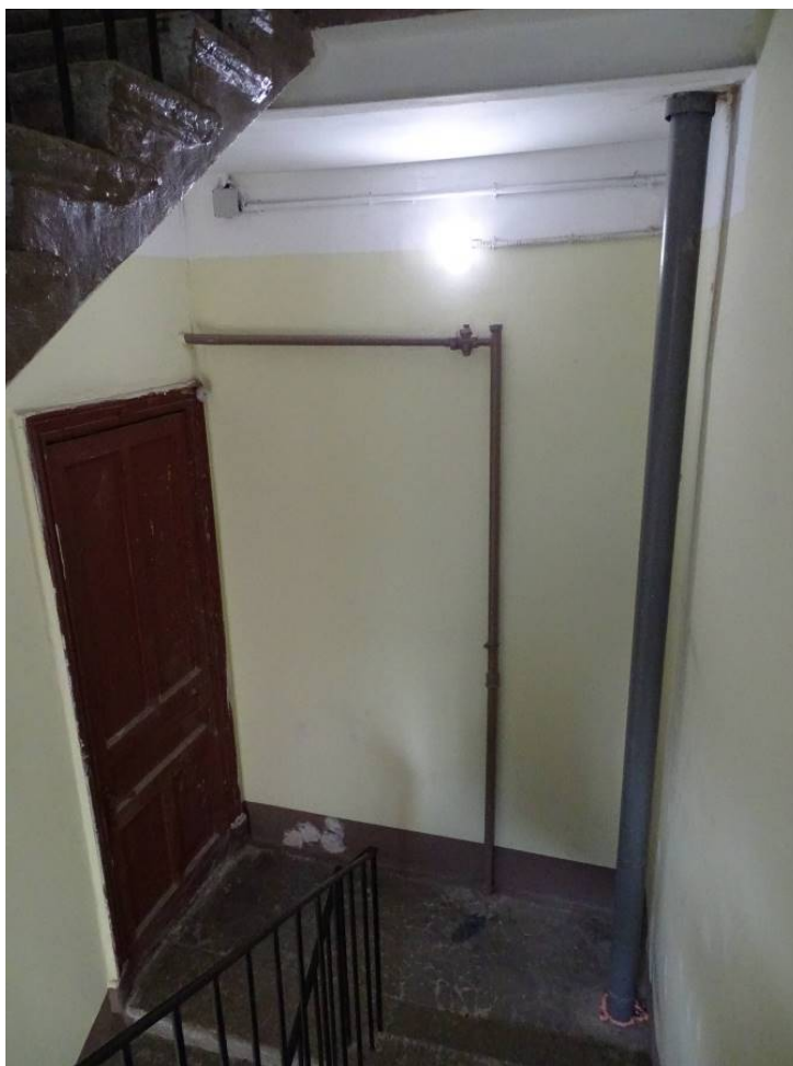
Фото 28. Лестница № 1. 5-й этаж. Съёмка 19.04.2021 г. Трушковский В.Э.
