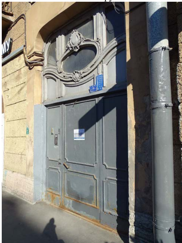
Фото 32. Здание по адресу: г. Санкт-Петербург, Большая Пушкарская ул., дом 1/8, литера А. Вид с Большой Пушкарской ул. Дверное заполнение. Съемка 19.04.2021 г. Трушковский В.Э.
