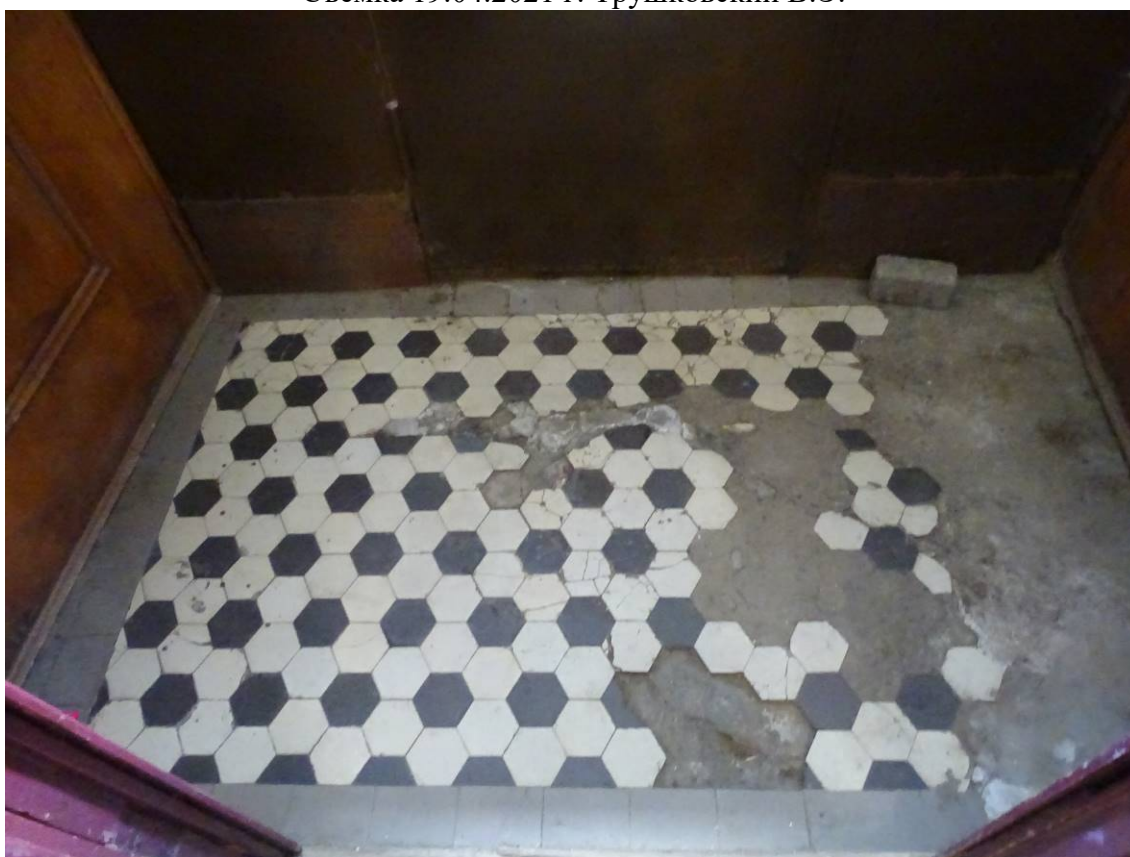
Фото 164. Лестница № 4. 1-й этаж. Входной тамбур. Покрытие пола. Съемка 19.04.2021 г. Трушковский В.Э.
