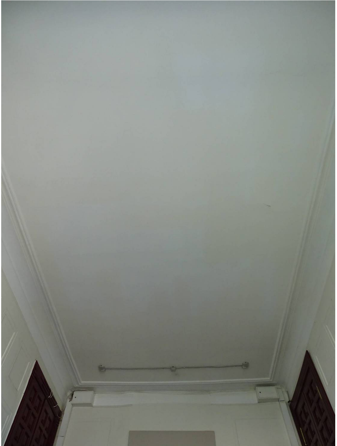
Фото 107. Лестница № 2. 6-й этаж. Оформление потолка Съемка 19.04.2021 г. Трушковский В.Э.
