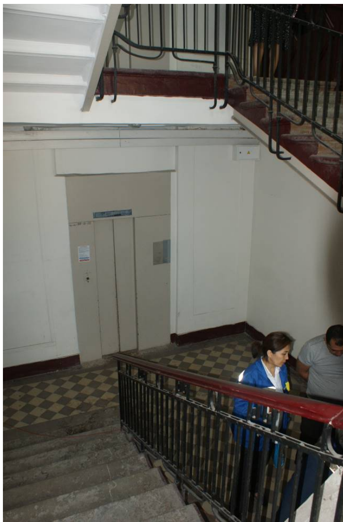
Фото 75. Лестница № 2. 1-й этаж. Съемка 19.04.2021 г. Трушковский В.Э.
