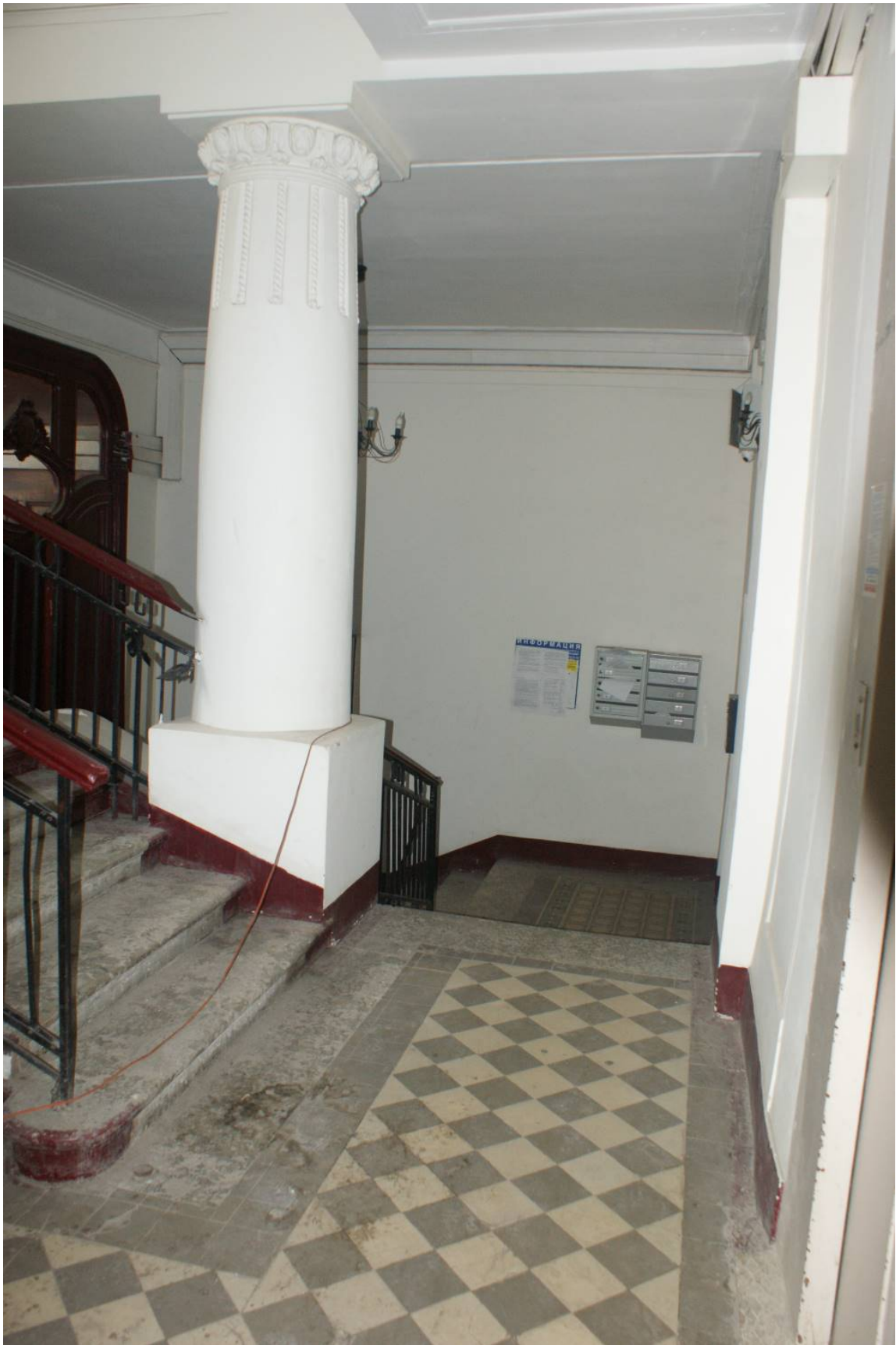
Фото 60. Лестница № 2. 1-й этаж. Парадная. Съемка 19.04.2021 г. Трушковский В.Э.
