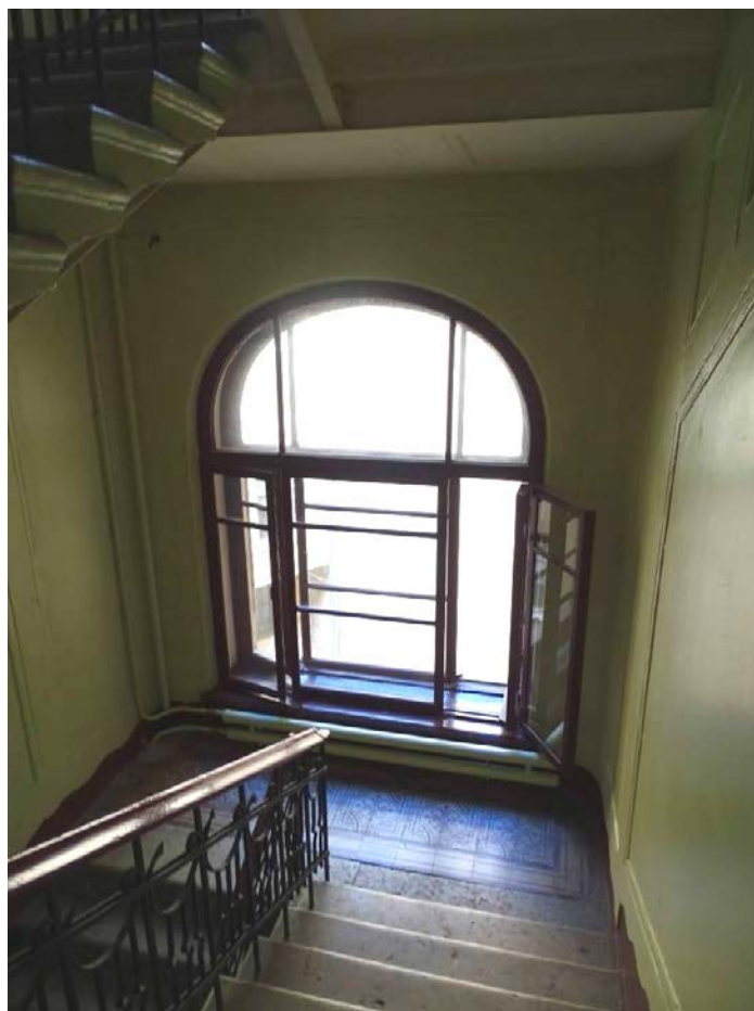
Фото 189. Лестница № 4. Площадка между 3-м и 4-м этажом. Съемка 19.04.2021 г. Трушковский В.Э.
