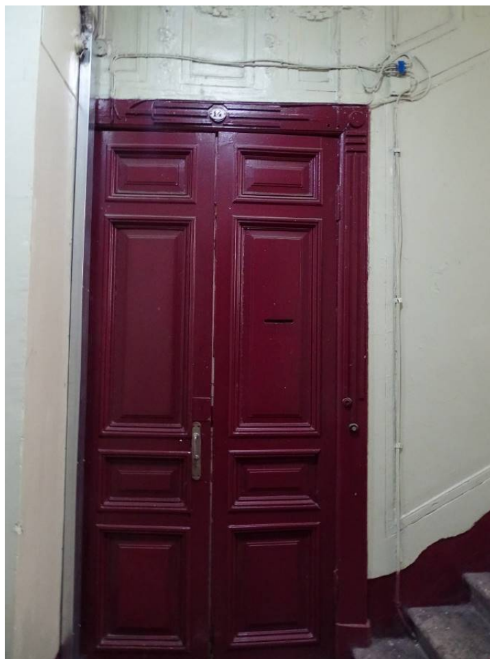
Фото 181. Лестница № 4. 2-й этаж. Съемка 19.04.2021 г. Трушковский В.Э.
