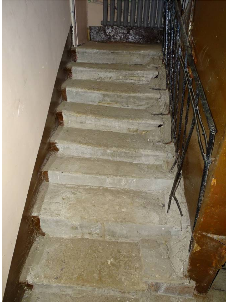
Фото 117. Лестница № 3. 1-й этаж. Ступени на площадку. Съемка 19.04.2021 г. Трушковский В.Э.
