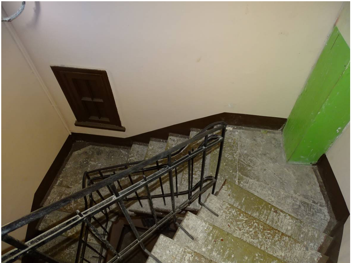
Фото 130. Лестница № 3. 4-й этаж. Съёмка 19.04.2021 г. Трушковский В.Э.
