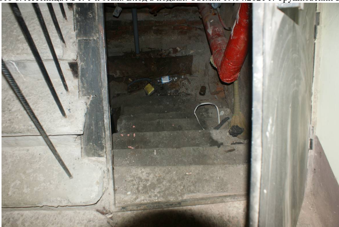
Фото 7. Лестница № 1. 1-й этаж. Вход в подвал. Съемка 19.04.2021 г. Трушковский В.Э.
