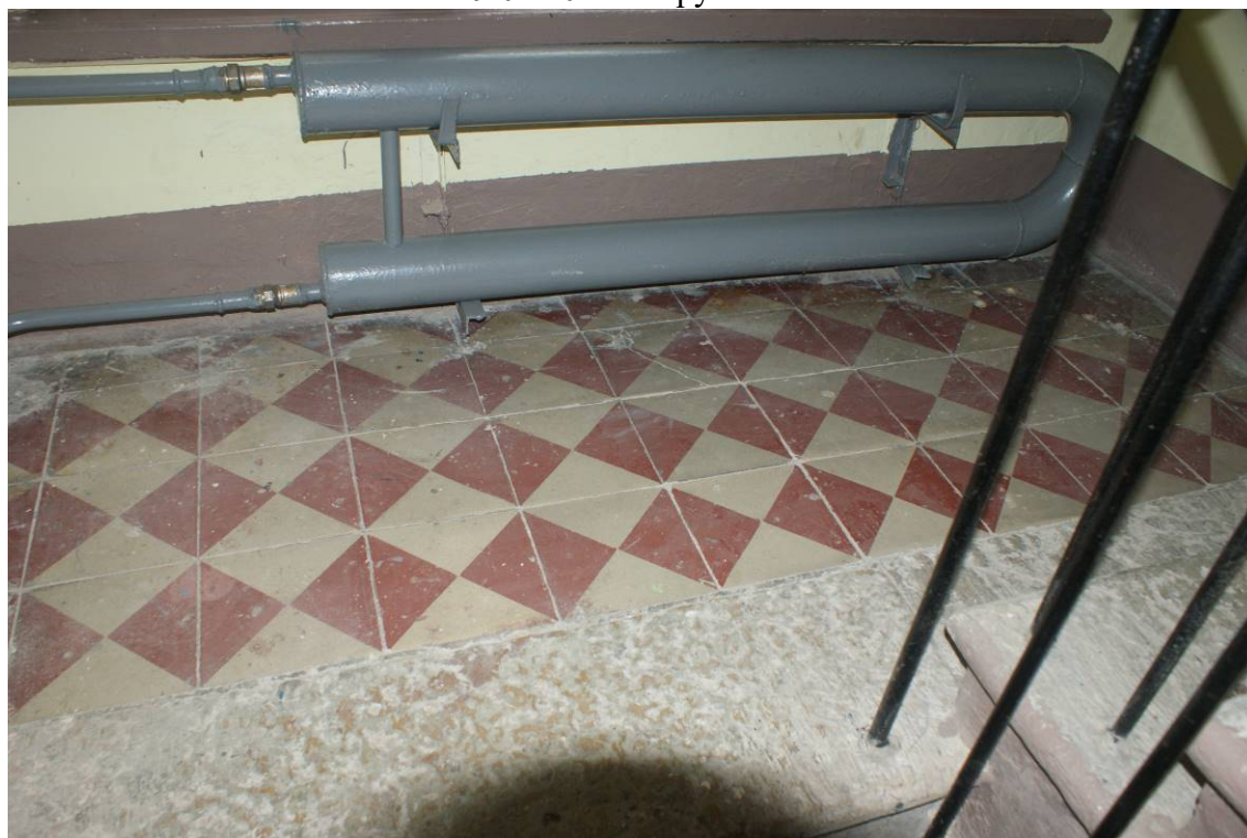
Фото 17. Лестница № 1. Площадка между 2-м и 3-м этажом. Покрытие пола. Съемка 19.04.2021 г. Трушковский В.Э.
