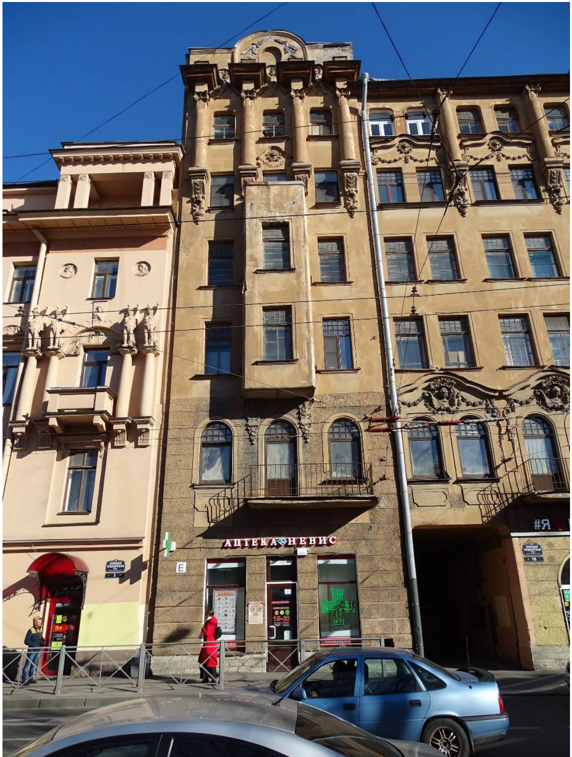
Фото 24. Здание по адресу: г. Санкт-Петербург, Большая Пушкарская ул., дом 1/8, литера А. Вид с Большой Пушкарской ул. Фрагмент. Съемка 19.04.2021 г. Трушковский В.Э.
