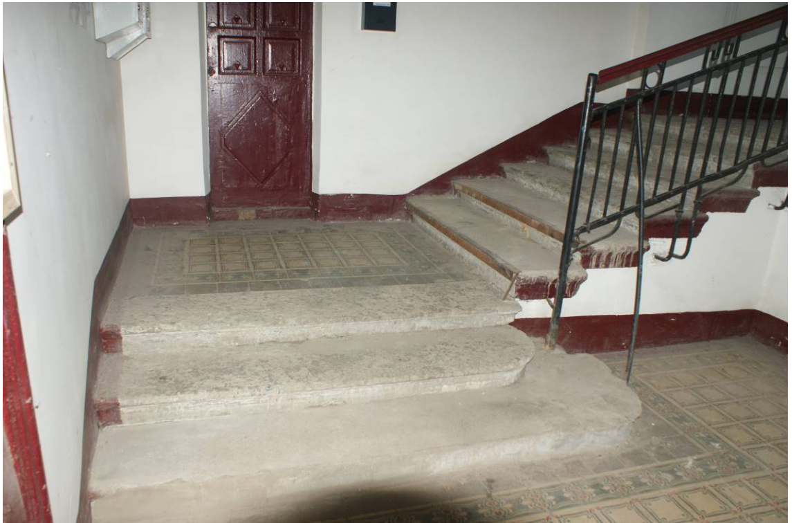
Фото 48. Лестница № 2. 1-й этаж. Парадная. Съемка 19.04.2021 г. Трушковский В.Э.
