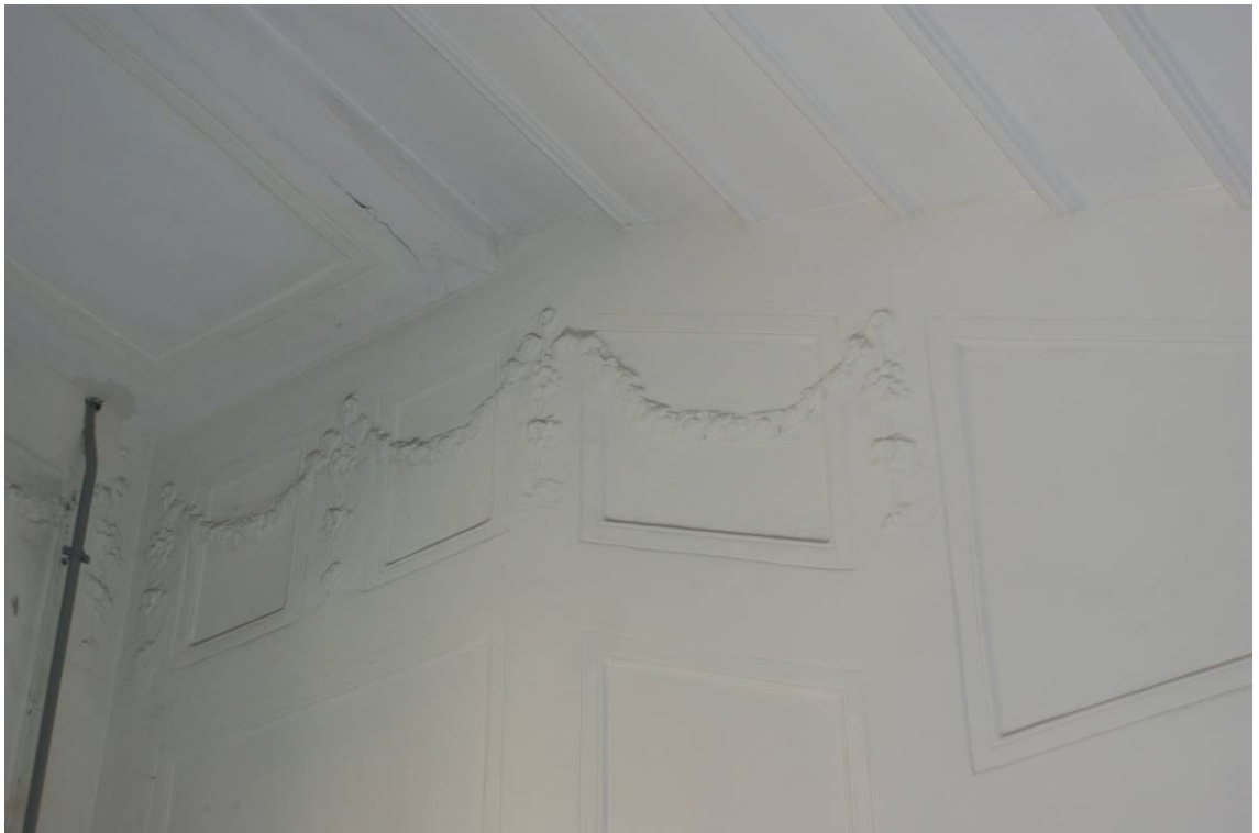
Фото 70. Лестница № 2. 1-й этаж. Парадная. Оформление стен. Съемка 19.04.2021 г. Трушковский В.Э.
