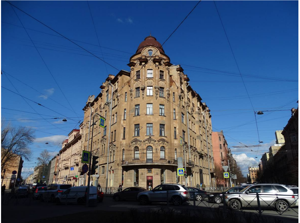
Фото 1. Здание по адресу: г. Санкт-Петербург, Большая Пушкарская ул., дом 1/8, литера А. Вид с пересечения Большой Пушкарской ул. и Съезжинской ул. Съемка 19.04.2021 г. Трушковский В.Э.
