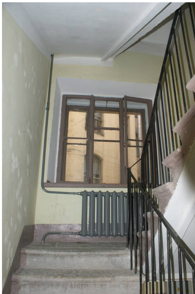
Фото 10. Лестница № 1. Площадка между 1-м и 2-м этажом. Съемка 19.04.2021 г. Трушковский В.Э.
