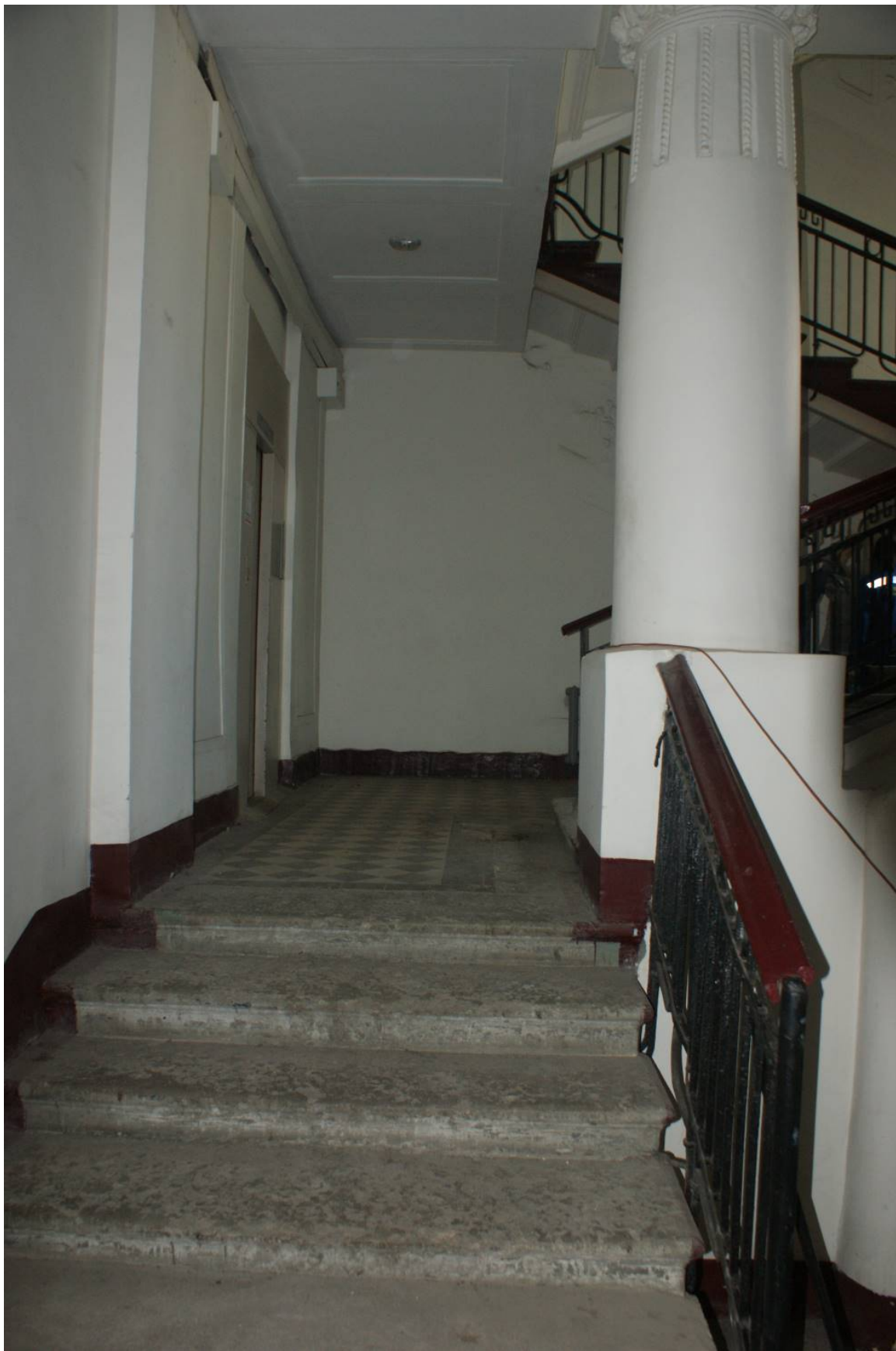
Фото 59. Лестница № 2. 1-й этаж. Парадная. Съемка 19.04.2021 г. Трушковский В.Э.
