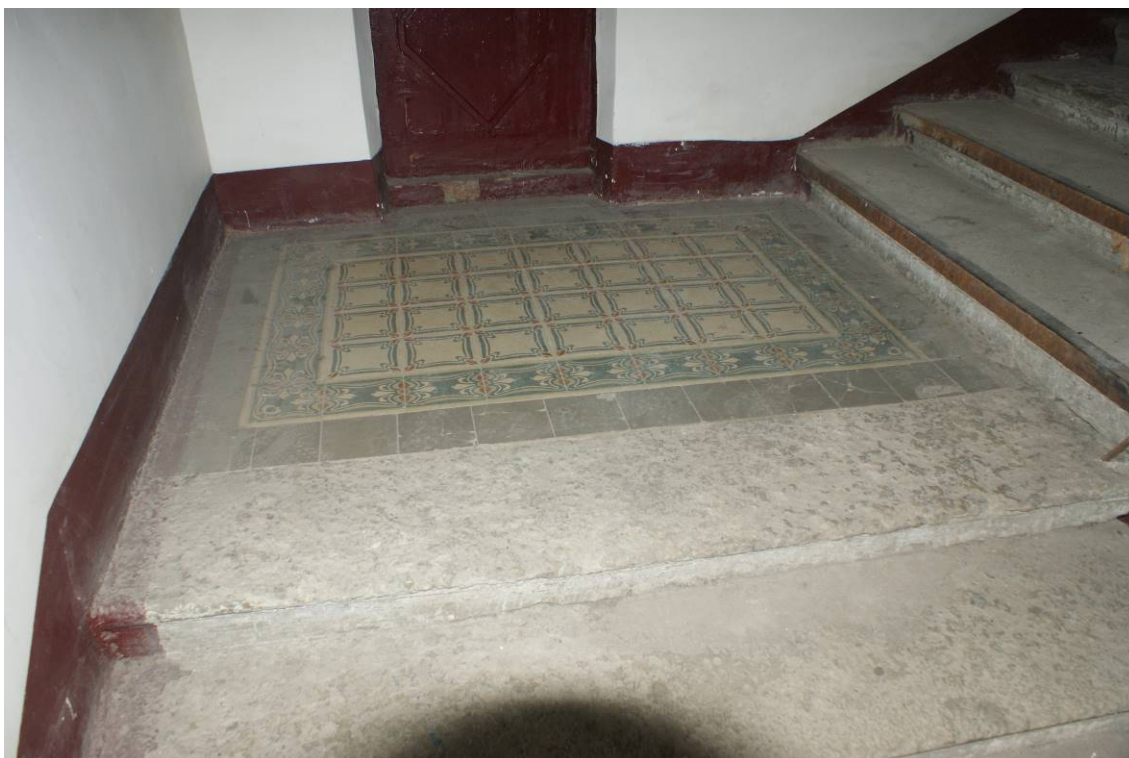
Фото 56. Лестница № 2. 1-й этаж. Парадная. Покрытие пола. Съемка 19.04.2021 г. Трушковский В.Э.
