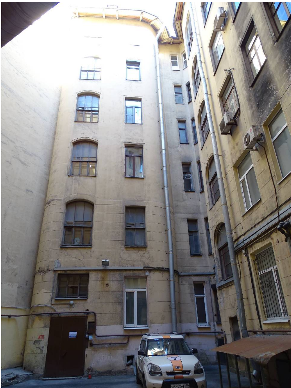
Фото 37. Здание по адресу: г. Санкт-Петербург, Большая Пушкарская ул., дом 1/8, литера А. Восточный фасад. Съемка 19.04.2021 г. Трушковский В.Э.
