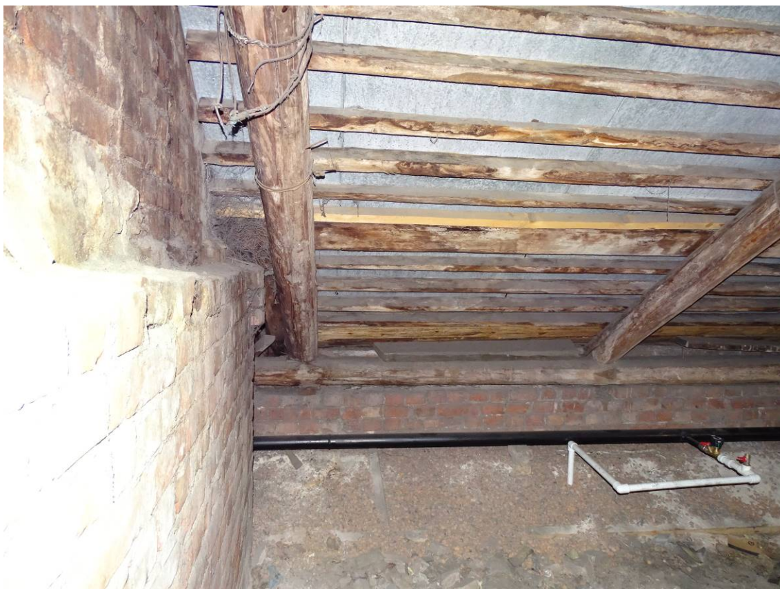
Фото 34. Лестница № 1. Чердачный этаж. Съемка 19.04.2021 г. Трушковский В.Э.
