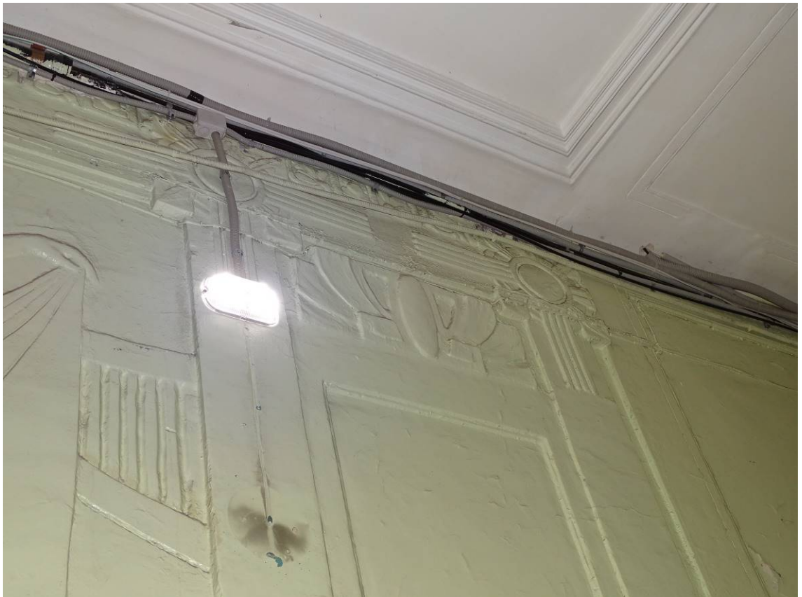
Фото 152. Лестница № 4. 1-й этаж. Парадная. Оформление стен. Съемка 19.04.2021 г. Трушковский В.Э.
