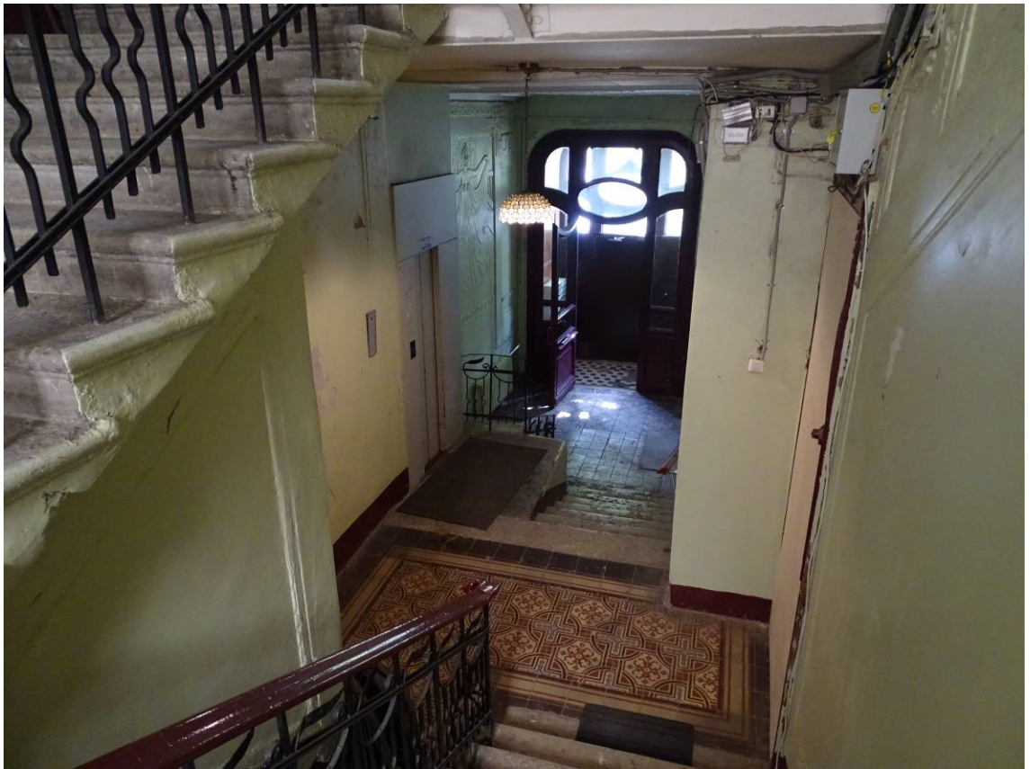
Фото 171. Лестница № 4. 1-й этаж. Парадная. Съемка 19.04.2021 г. Трушковский В.Э.
