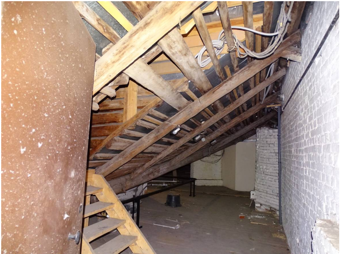
Фото 40. Лестница № 1. Чердачный этаж. Съемка 19.04.2021 г. Трушковский В.Э.
