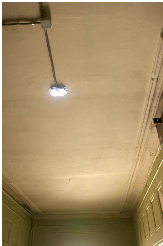
Фото 205. Лестница № 4. 6-й этаж. Оформление потолка. Съемка 19.04.2021 г. Трушковский В.Э.
