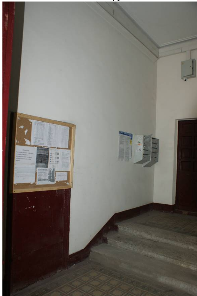
Фото 53. Лестница № 2. 1-й этаж. Парадная. Съемка 19.04.2021 г. Трушковский В.Э.
