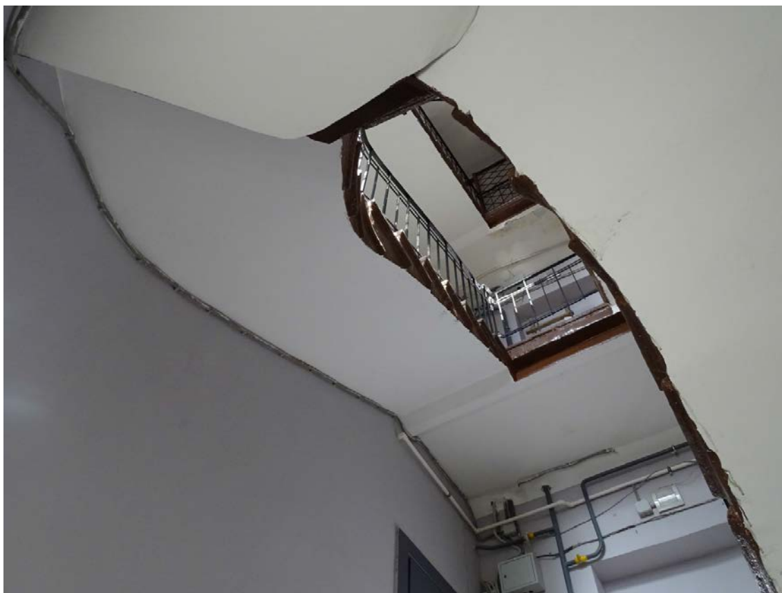
Фото 122. Лестница № 4. Лестница. Съемка 19.04.2021 г. Штиглиц М. С.
