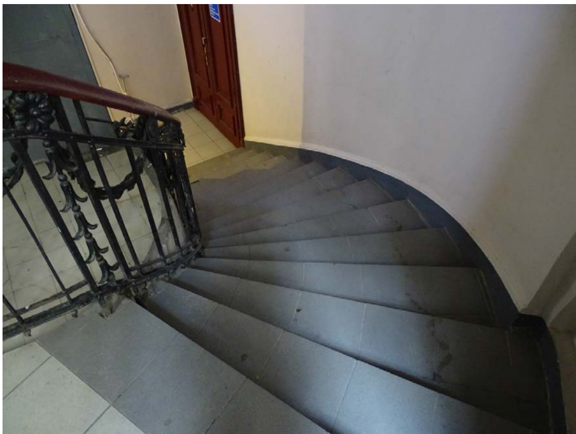
Фото 8. Лестница № 1. Площадка между 1-м и 2-м этажом. Съемка 19.04.2021 г. Штиглиц М. С.
