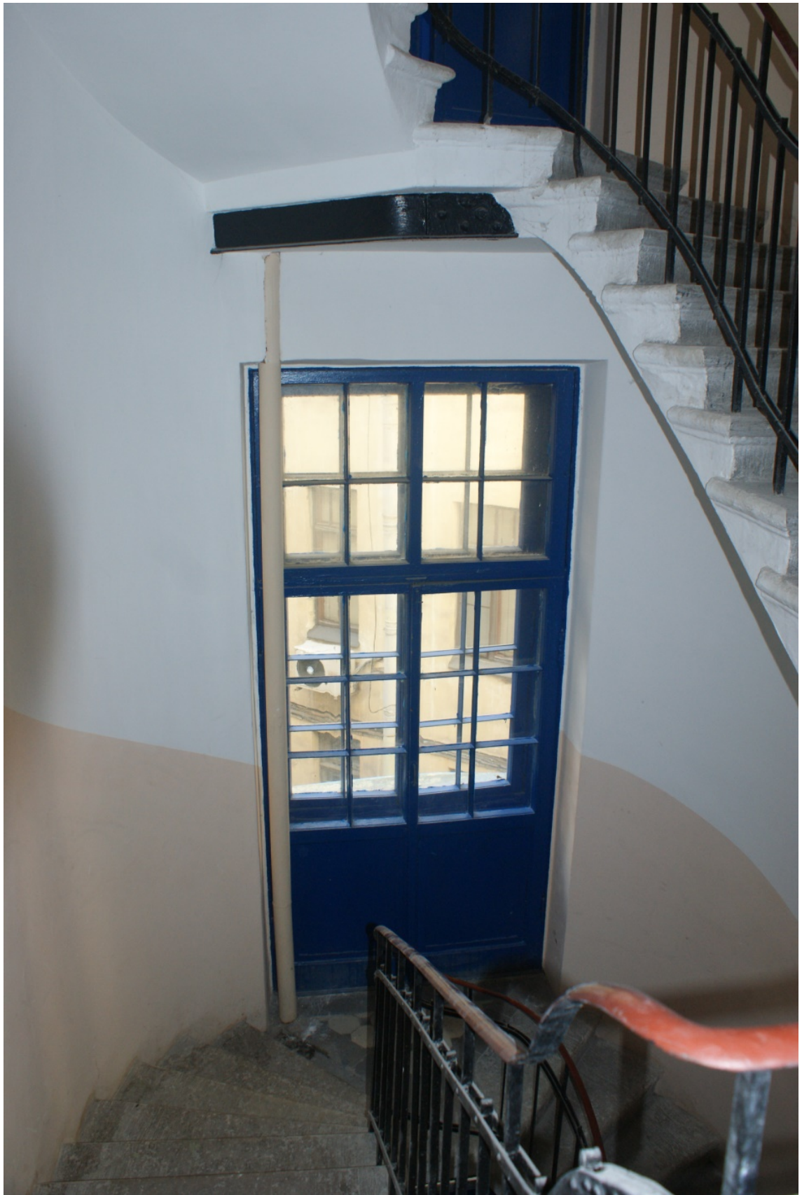
Фото 84. Лестница № 3. Площадка между 2-м и 3-м этажом. Съемка 19.04.2021 г. Штиглиц М. С.
