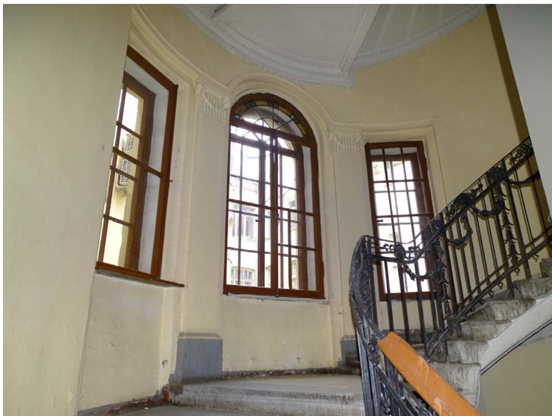
Фото 20. Лестница № 1. Площадка между 3-м и 4-м этажом. Съемка 19.04.2021 г. Штиглиц М. С.
