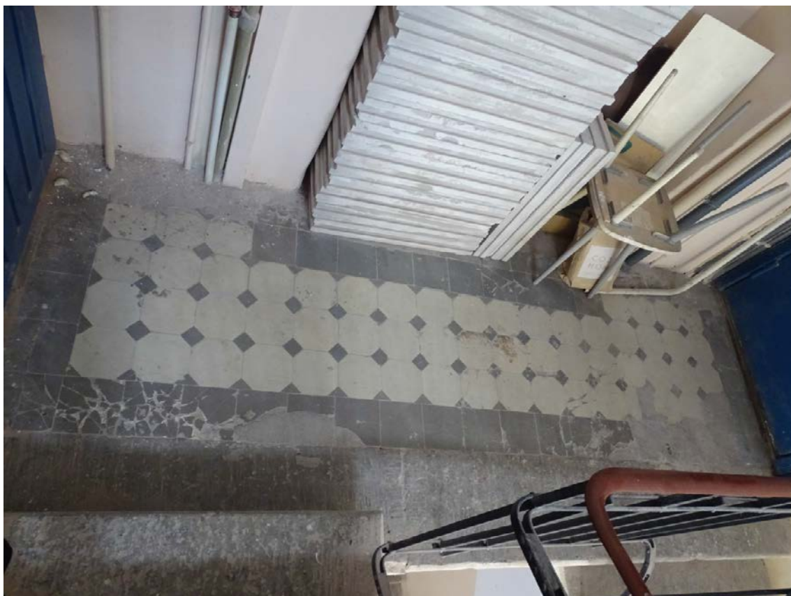
Фото 93. Лестница № 3. 5-й этаж. Покрытие пола. Съёмка 19.04.2021 г. Штиглиц М. С.
