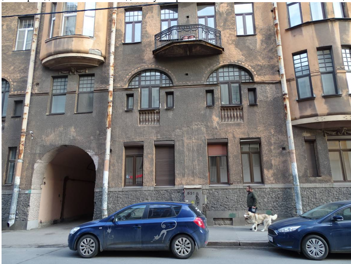
Фото 16. Здание по адресу: г. Санкт-Петербург, Большая Посадская, дом 1/10, литера А. Лицевой фасад по Большой Посадской ул. Фрагмент. Съемка 19.04.2021 г. Штиглиц М. С.
