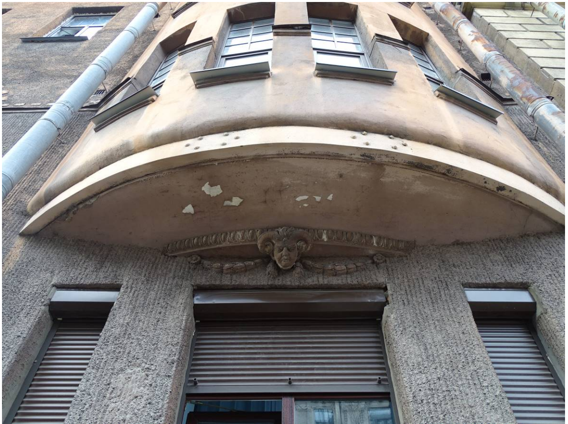
Фото 5. Здание по адресу: г. Санкт-Петербург, Большая Посадская, дом 1/10, литера А. Лицевой фасад по Малой Посадской ул. Фрагмент эркера. Съемка 19.04.2021 г. Штиглиц М. С.
