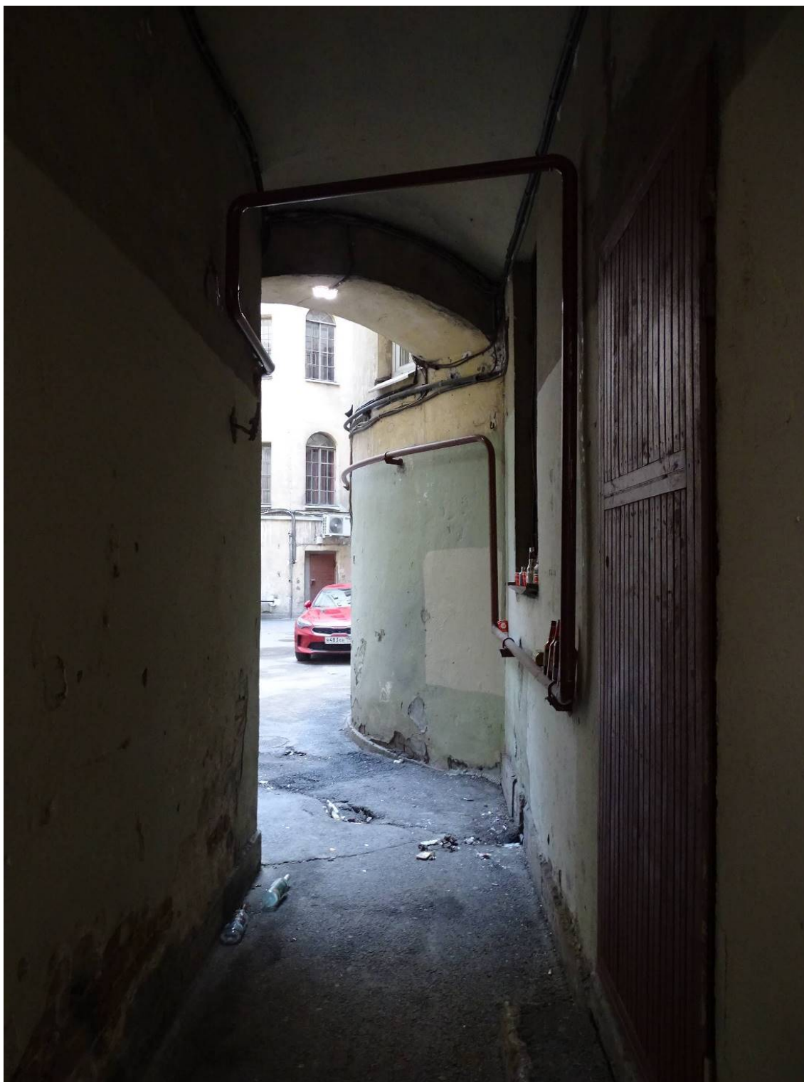
Фото 33. Здание по адресу: г. Санкт-Петербург, Большая Посадская, дом 1/10, литера А. Внутренний двор. Проход между дворовыми корпусами. Съемка 19.04.2021 г. Штиглиц М. С.
