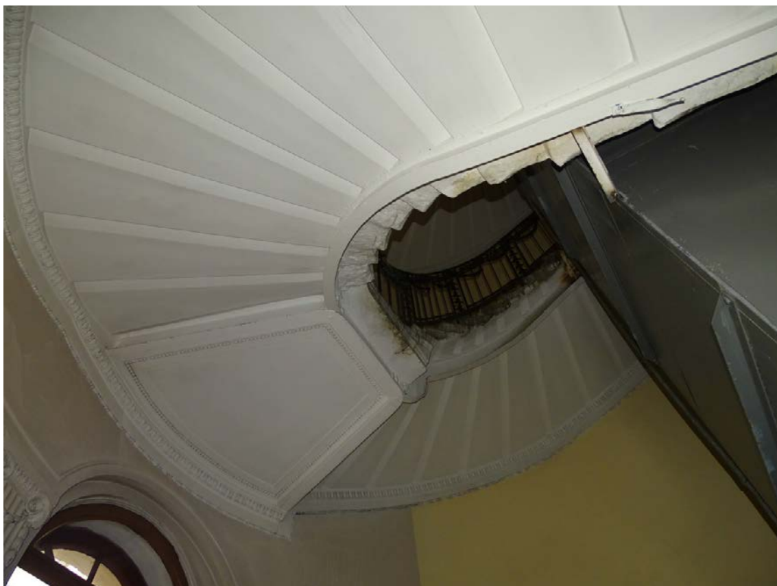
Фото 16. Лестница № 1. Площадка между 2-м и 3-м этажом. Оформление потолка. Съемка 19.04.2021 г. Штиглиц М. С.
