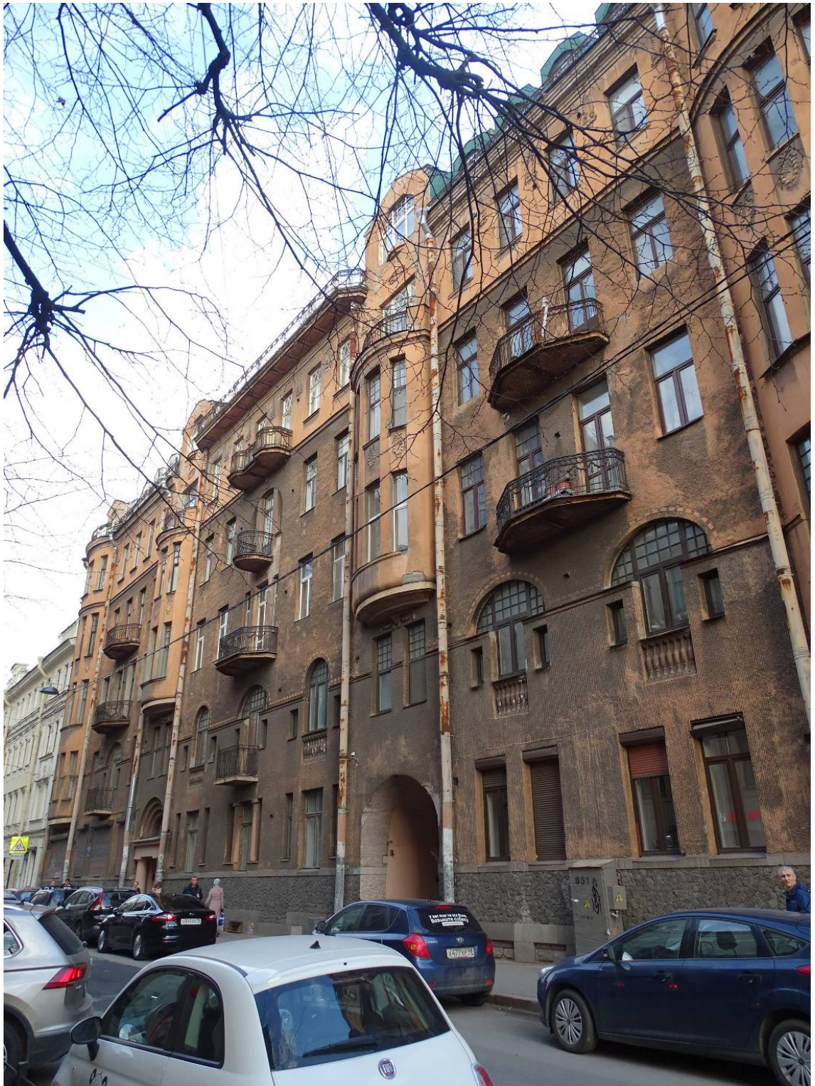
Фото 14. Здание по адресу: г. Санкт-Петербург, Большая Посадская, дом 1/10, литера А. Лицевой фасад по Большой Посадской ул. Фрагмент. Съемка 19.04.2021 г. Штиглиц М. С.
