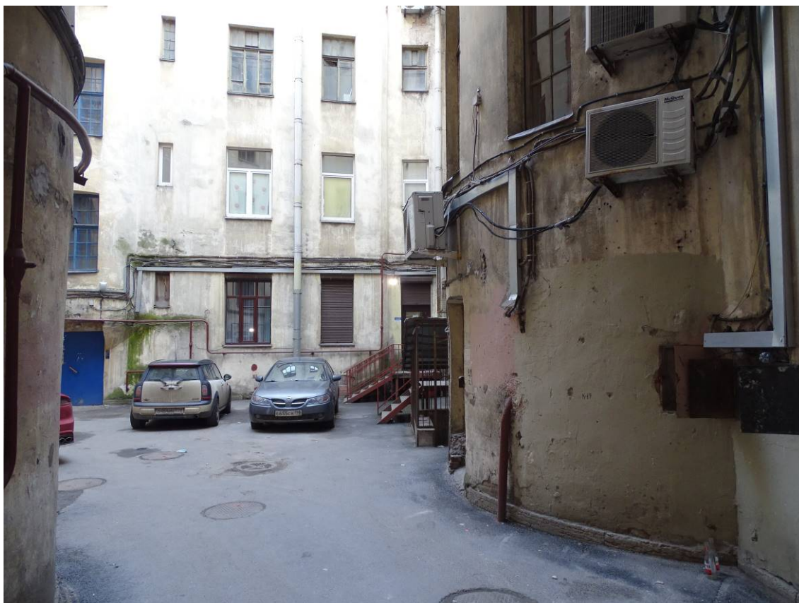
Фото 26. Здание по адресу: г. Санкт-Петербург, Большая Посадская, дом 1/10, литера А. Внутренний двор. Съемка 19.04.2021 г. Штиглиц М. С.
