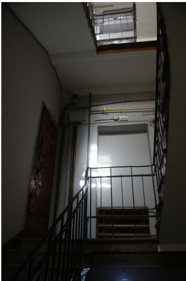
Фото 115. Лестница № 4. Лестница № 4. 4-й этаж. Съемка 19.04.2021 г. Штиглиц М. С.
