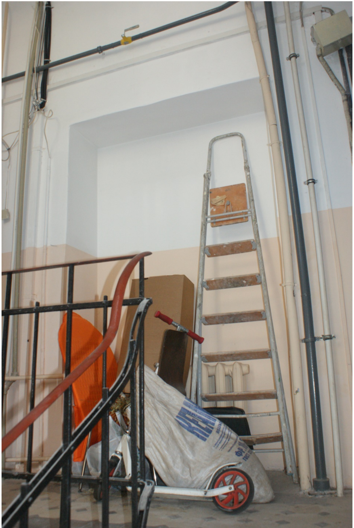
Фото 89. Лестница № 3. 4-й этаж. Съёмка 19.04.2021 г. Штиглиц М. С.
