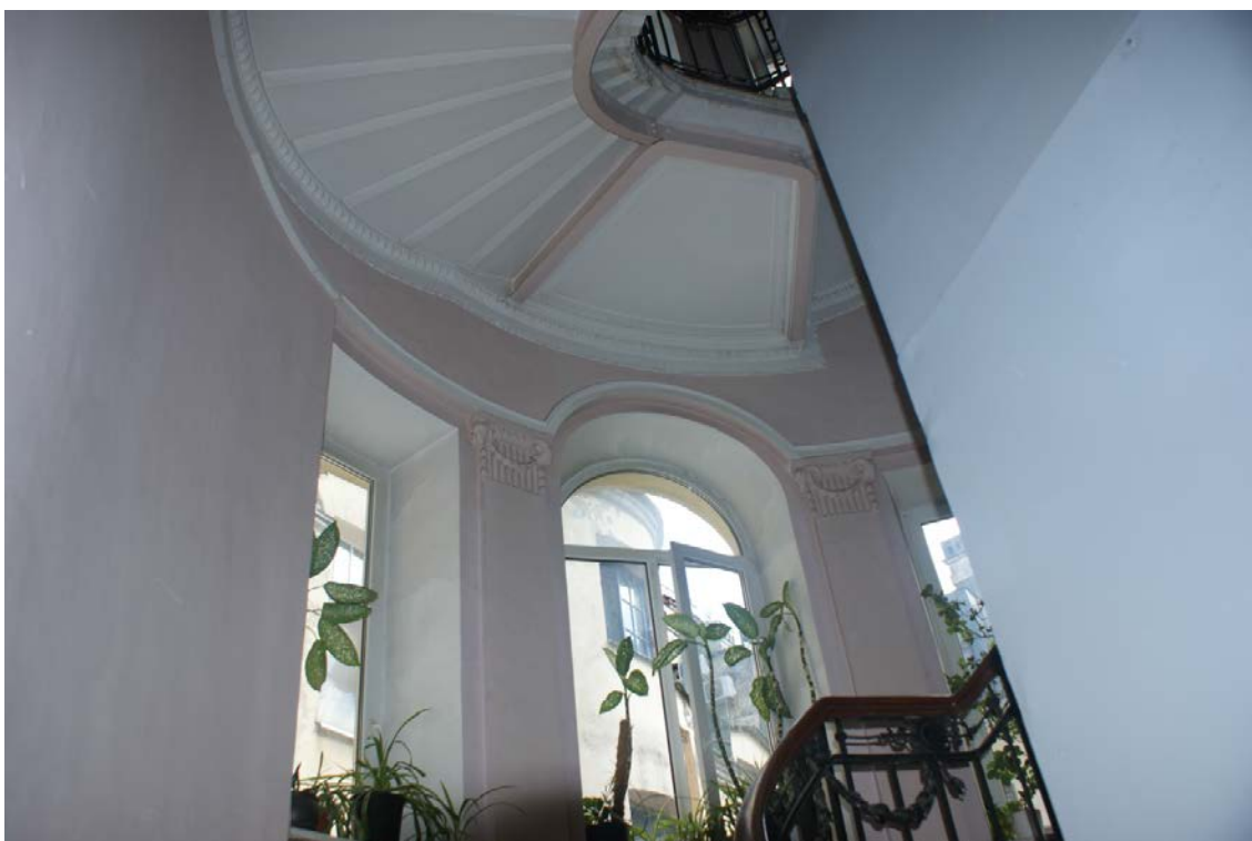
Фото 60. Лестница № 2. Площадка между 4-м и 5-м этажом. Съёмка 19.04.2021 г. Штиглиц М. С.
