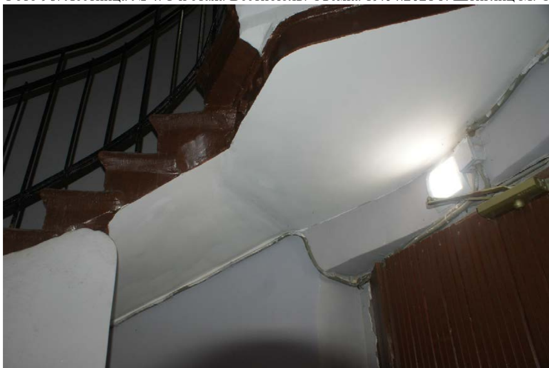
Фото 99. Лестница № 4. 1-й этаж. Вестибюль. Съемка 19.04.2021 г. Штиглиц М. С.
