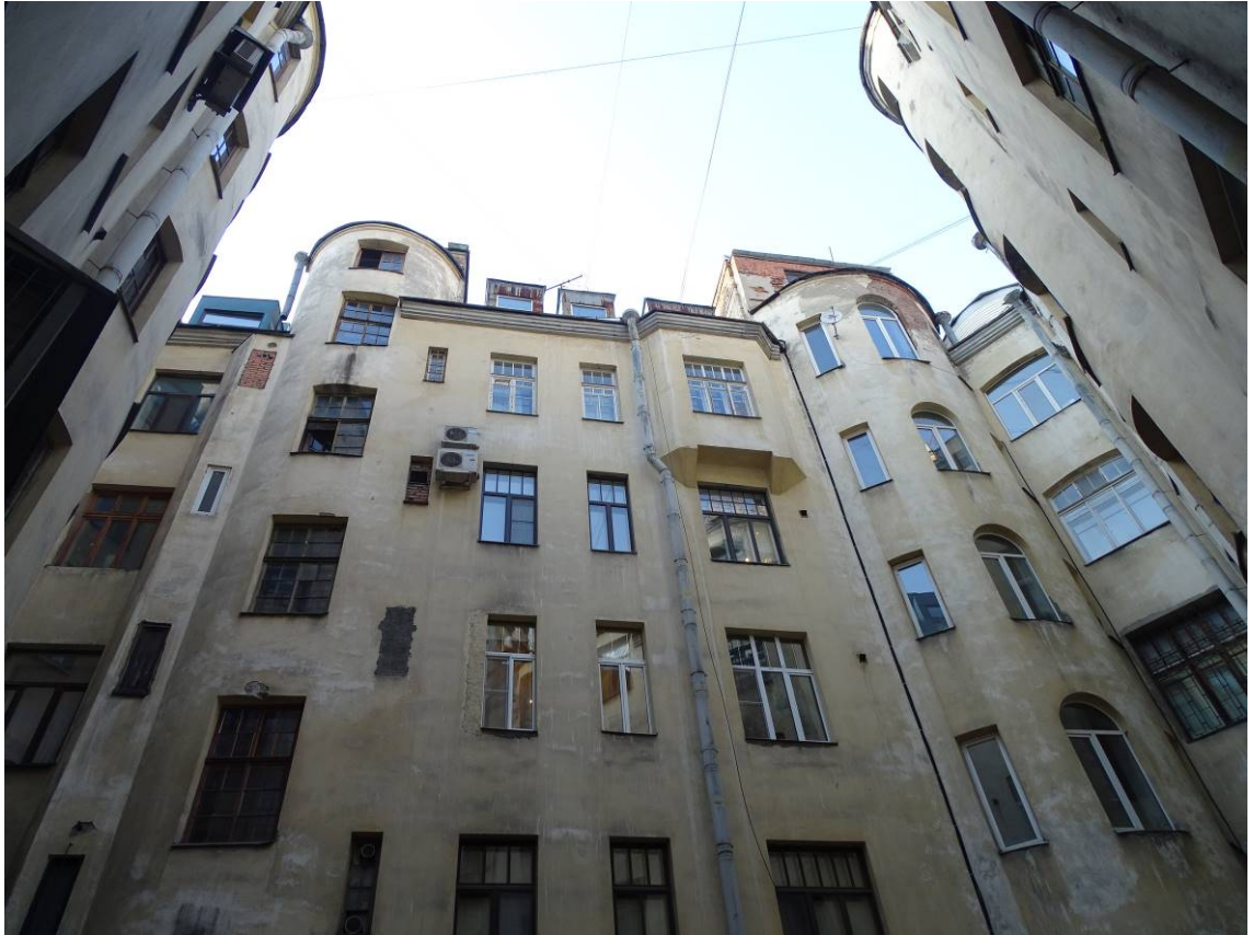
Фото 30. Здание по адресу: г. Санкт-Петербург, Большая Посадская, дом 1/10, литера А. Внутренний двор. Съемка 19.04.2021 г. Штиглиц М. С.
