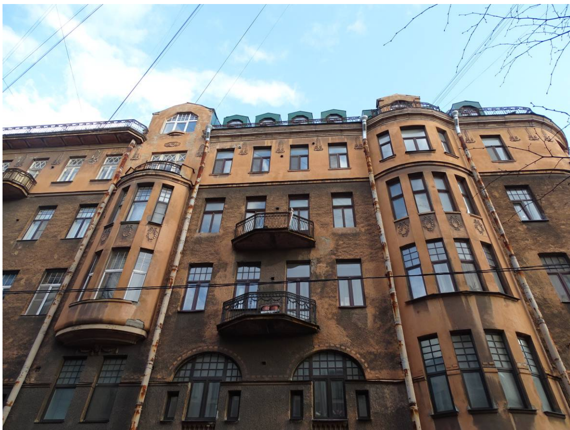
Фото 15. Здание по адресу: г. Санкт-Петербург, Большая Посадская, дом 1/10, литера А. Лицевой фасад по Большой Посадской ул. Фрагмент. Съемка 19.04.2021 г. Штиглиц М. С.
