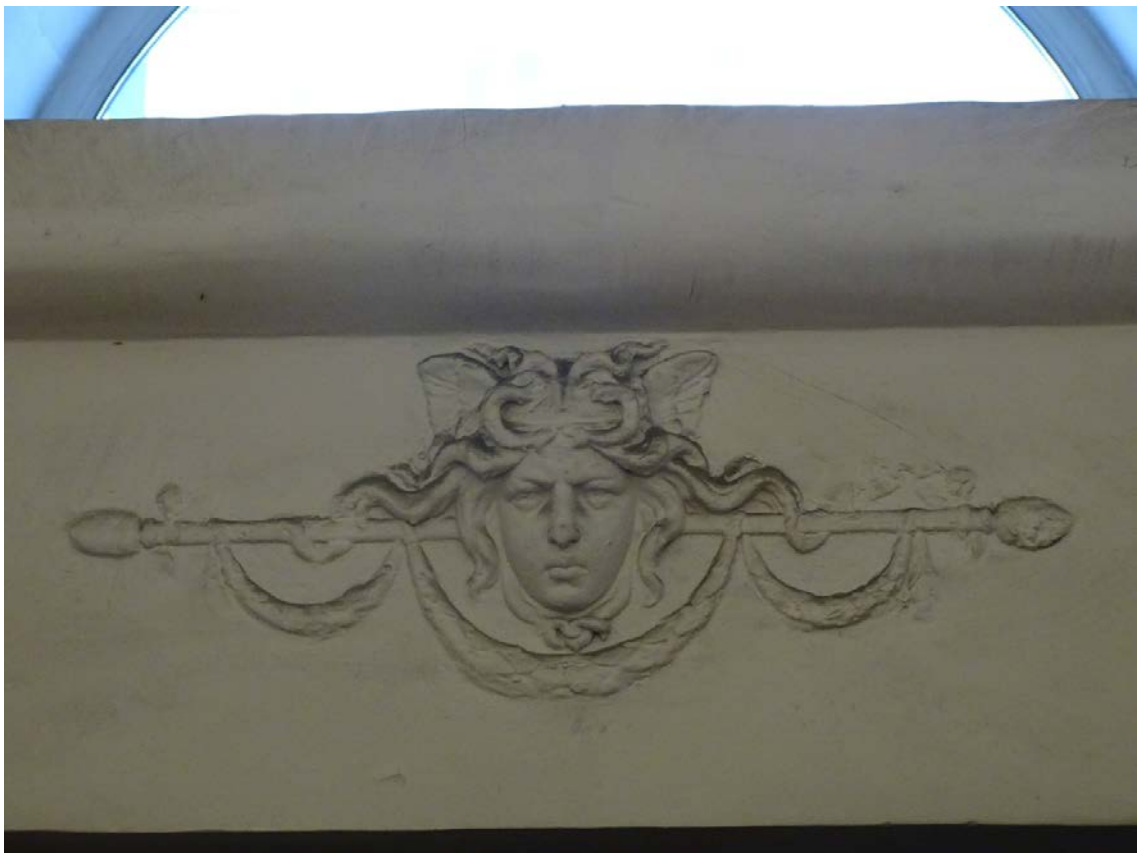
Фото 38. Лестница № 2. 1-й этаж. Вестибюль. Фрагмент. Съемка 19.04.2021 г. Штиглиц М. С.
