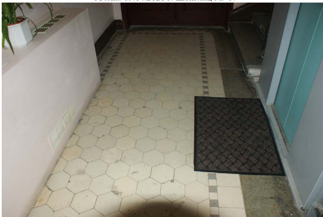
Фото 56. Лестница № 2. 4-й этаж. Покрытие пола. Съемка 19.04.2021 г. Штиглиц М. С.
