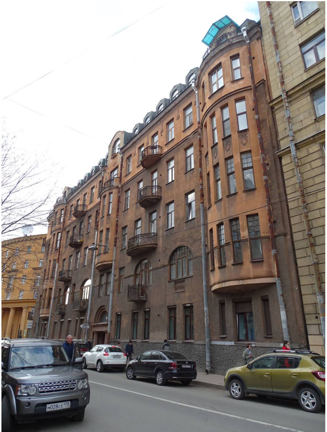
Фото 3. Здание по адресу: г. Санкт-Петербург, Большая Посадская, дом 1/10, литера А. Лицевой фасад по Малой Посадской ул. Съемка 19.04.2021 г. Штиглиц М. С.
