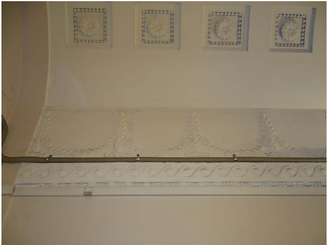
Фото 6. Лестница № 1. 1-й этаж. Оформление потолка. Съемка 19.04.2021 г. Штиглиц М. С.
