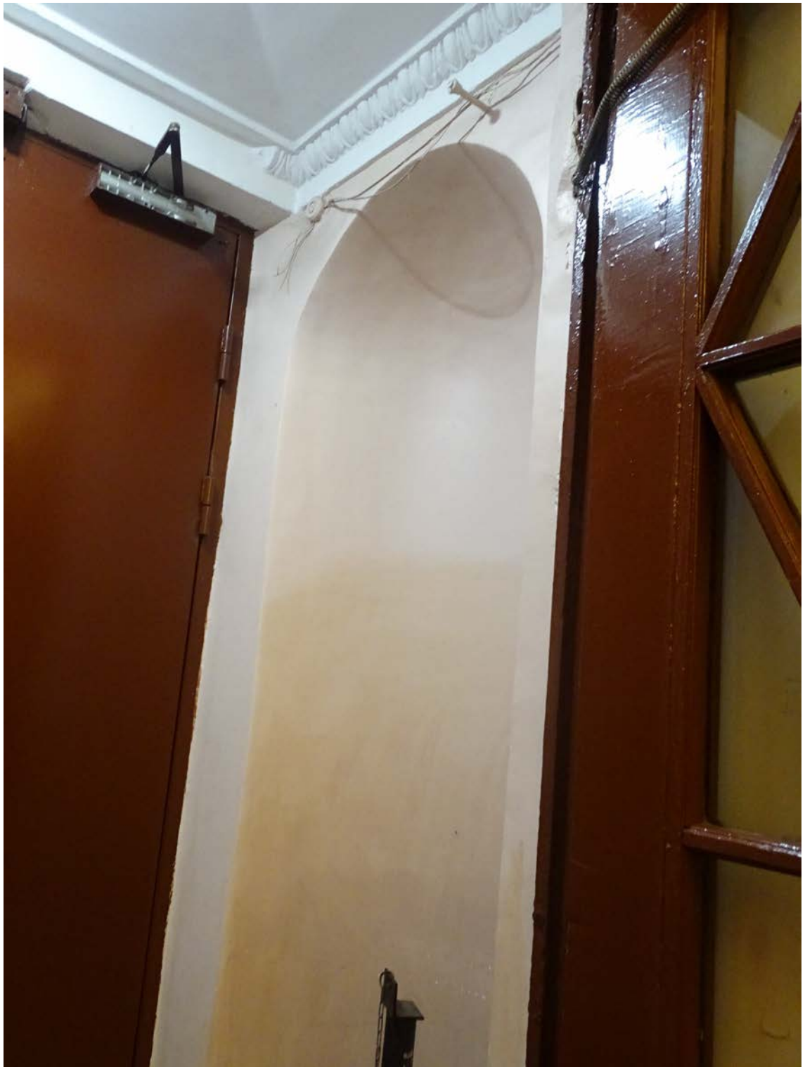
Фото 34. Лестница № 2. 1-й этаж. Тамбур. Съёмка 19.04.2021 г. Штиглиц М. С.
