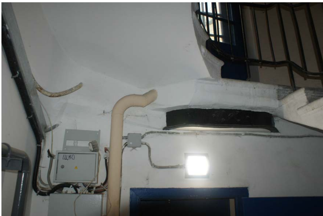
Фото 77. Лестница № 3. 1-й этаж. Вестибюль. Съёмка 19.04.2021 г. Штиглиц М. С.
