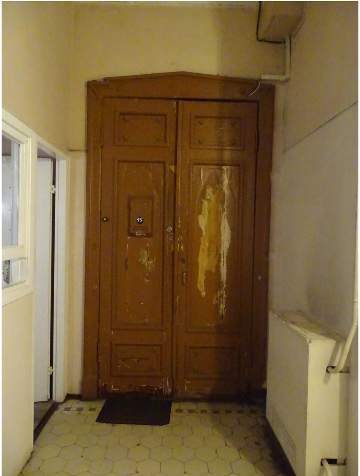
Фото 41. Лестница № 2. Вестибюль 1-го этажа. Съемка 19.04.2021 г. Штиглиц М. С.
