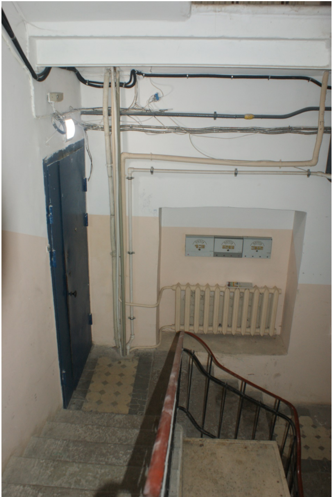
Фото 80. Лестница № 3. Вестибюль 1-го этажа. Съемка 19.04.2021 г. Штиглиц М. С.
