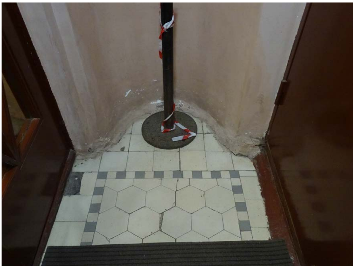
Фото 35. Лестница № 2. 1-й этаж. Тамбур. Съёмка 19.04.2021 г. Штиглиц М. С.
