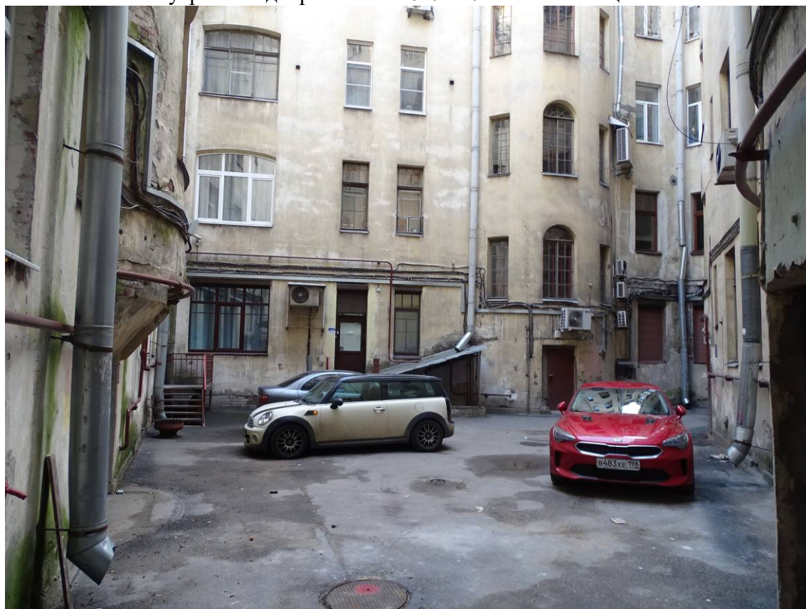
Фото 29. Здание по адресу: г. Санкт-Петербург, Большая Посадская, дом 1/10, литера А. Внутренний двор. Съемка 19.04.2021 г. Штиглиц М. С.
