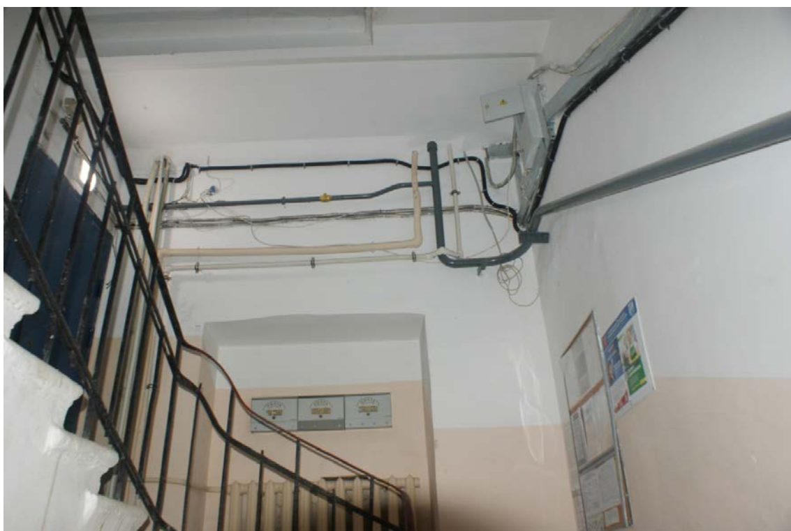
Фото 78. Лестница № 3. 1-й этаж. Вестибюль. Съёмка 19.04.2021 г. Штиглиц М. С.
