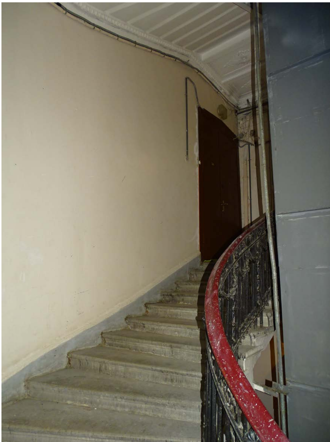
Фото 11. Лестница № 1. Площадка 2-го этажа. Съемка 19.04.2021 г. Штиглиц М. С.
