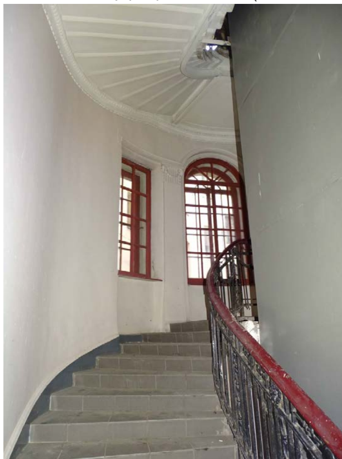
Фото 9. Лестница № 1. Площадка между 1-м и 2-м этажом. Съемка 19.04.2021 г. Штиглиц М. С.
