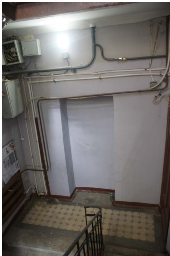
Фото 100. Лестница № 4. Площадка 1-го этажа. Съемка 19.04.2021 г. Штиглиц М. С.
