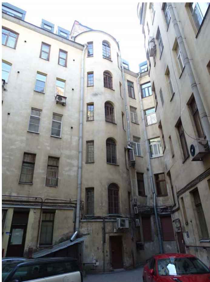
Фото 28. Здание по адресу: г. Санкт-Петербург, Большая Посадская, дом 1/10, литера А. Внутренний двор. Съемка 19.04.2021 г. Штиглиц М. С.
