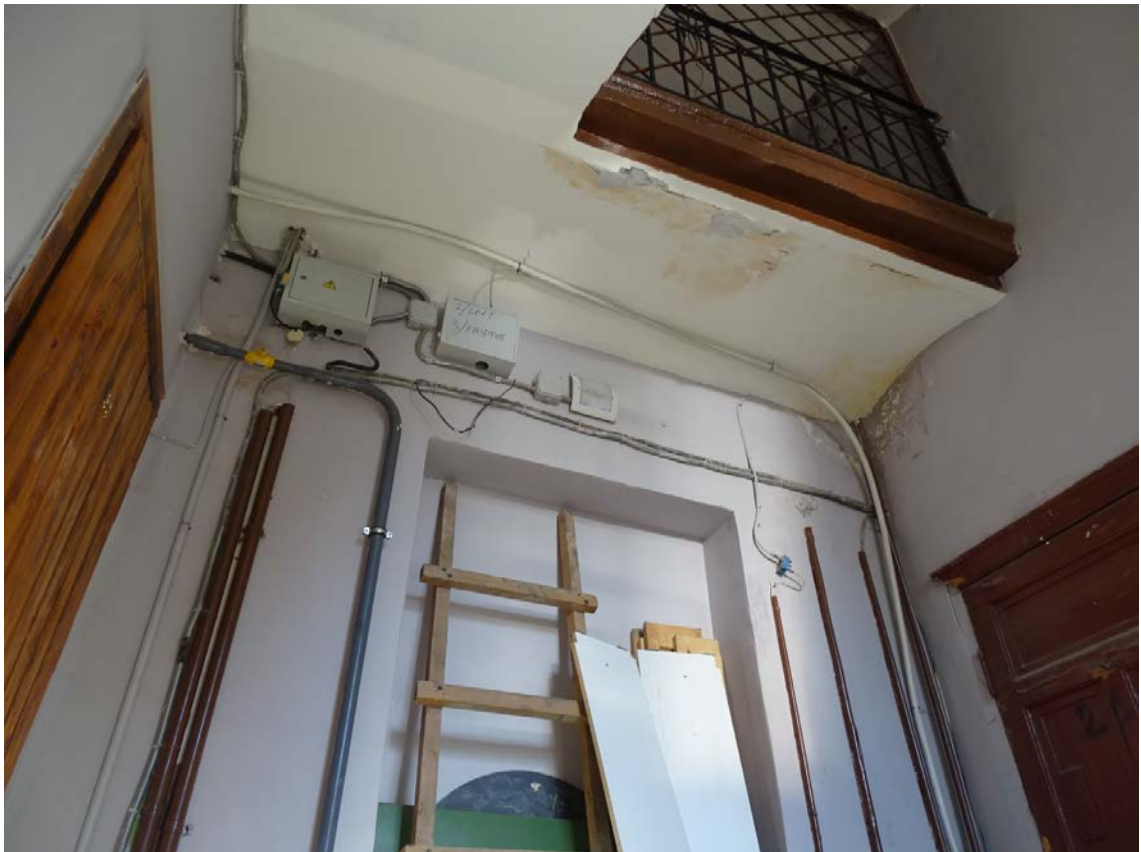
Фото 131. Лестница № 4. 6-й этаж. Съёмка 19.04.2021 г. Штиглиц М. С.
