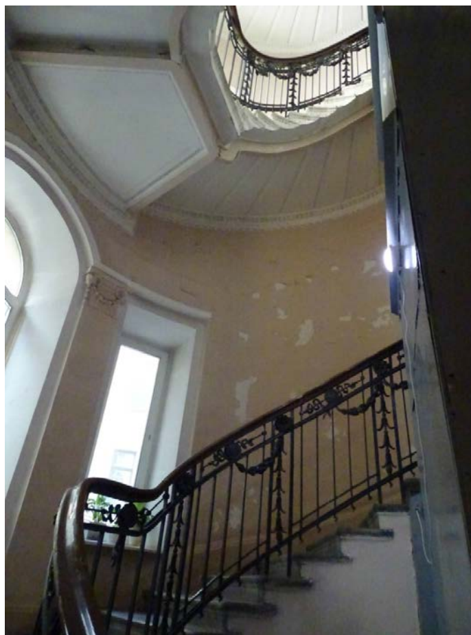
Фото 44. Лестница № 2. Площадка между 1-м и 2-м этажом. Съемка 19.04.2021 г. Штиглиц М. С.
