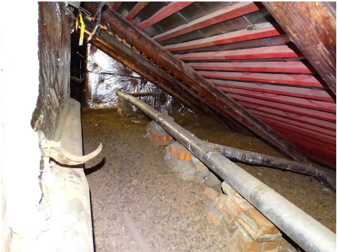
Фото 138. Лестница № 4. Чердачный этаж. Съемка 19.04.2021 г. Штиглиц М. С.
