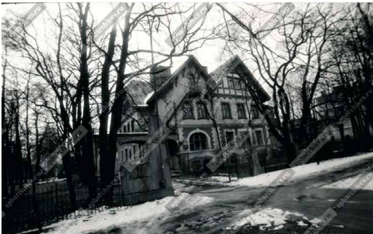
3. Вид особняка графа В.В.Гудовича с садом и оградой Парковой улице, 18 (архитекторы С.А.Данини, Р.Ф.Мельцер, 1905-1906 гг.). Дата съёмки: 18 апреля 1992 год. ЦГАКФФД СПб Ар 248001
