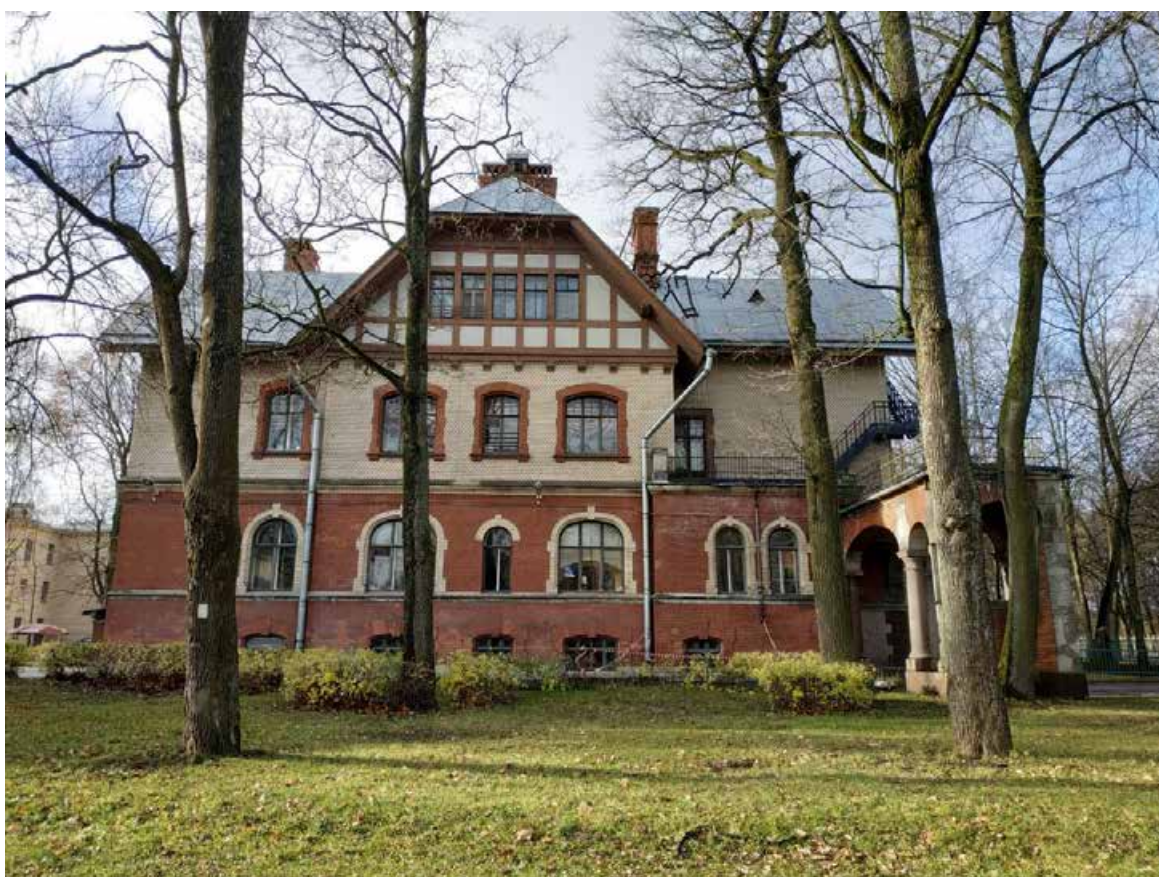
Фото 4. Дом Гудовича В.В. Вид на восточный фасад.
