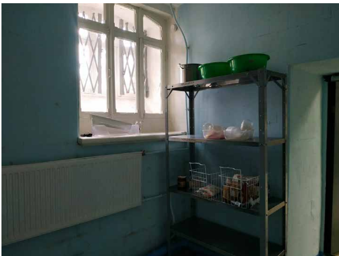
Фото 8. Фрагмент интерьера. Подвал.
