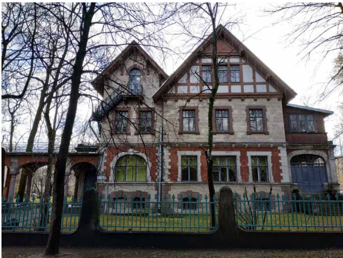
Фото 3. Дом Гудовича В.В. Вид на северный фасад.
