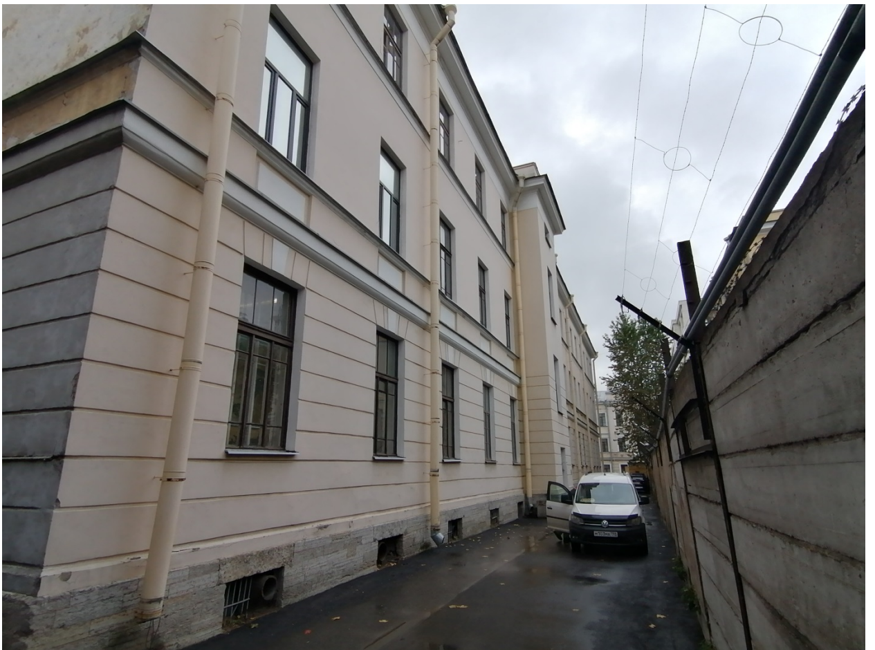
6. Боковой фасад (западный). Вид с севера.
