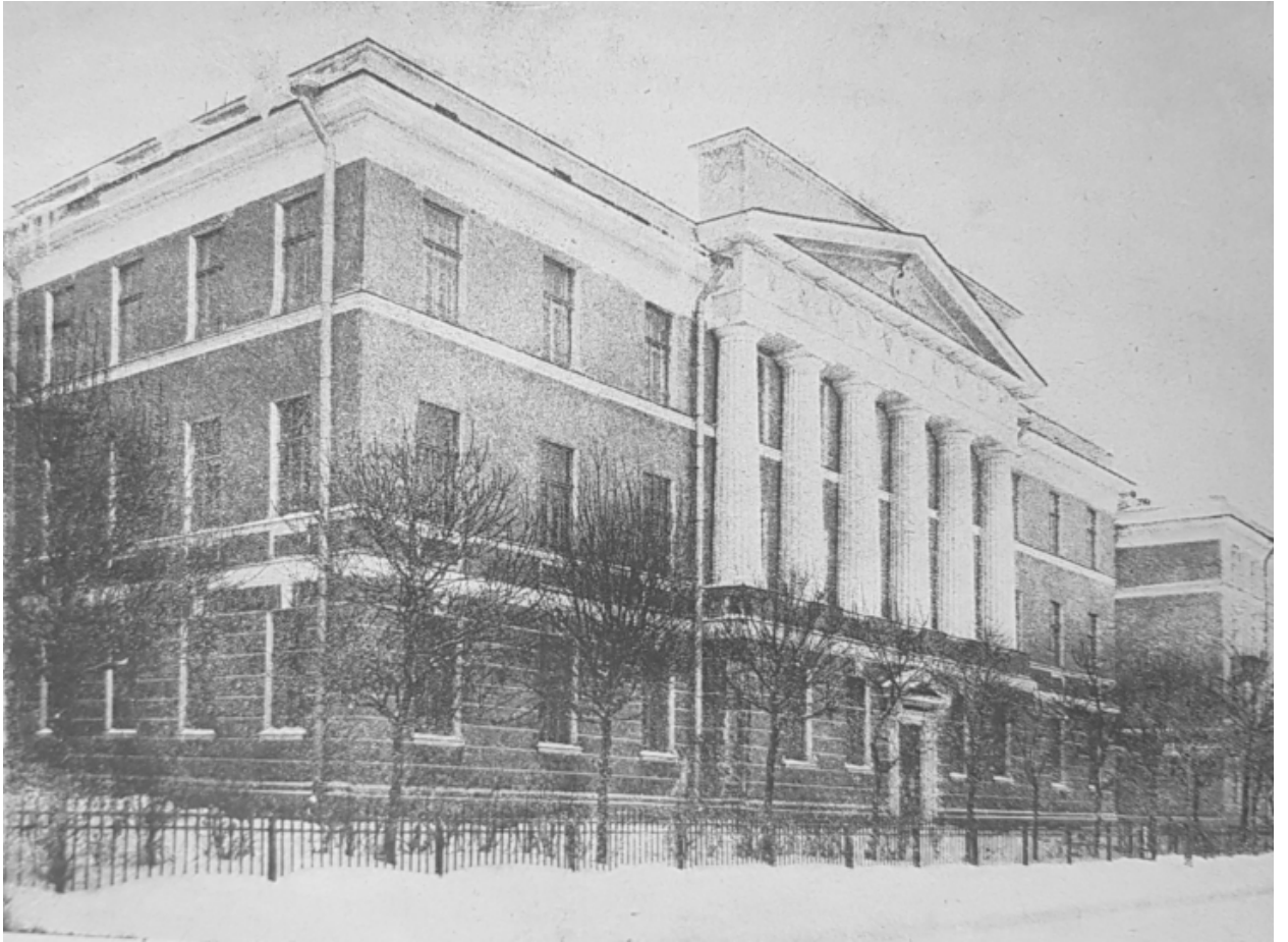
3. Здание электро-технической и воздухоплавательной лаборатории (совр. адрес: ул. Госпитальная, д.3, лит. Б). Фото 1920 г. Воспроизводится по изданию: Описание Центральной научно-технической лаборатории. Пгд. 1920.
