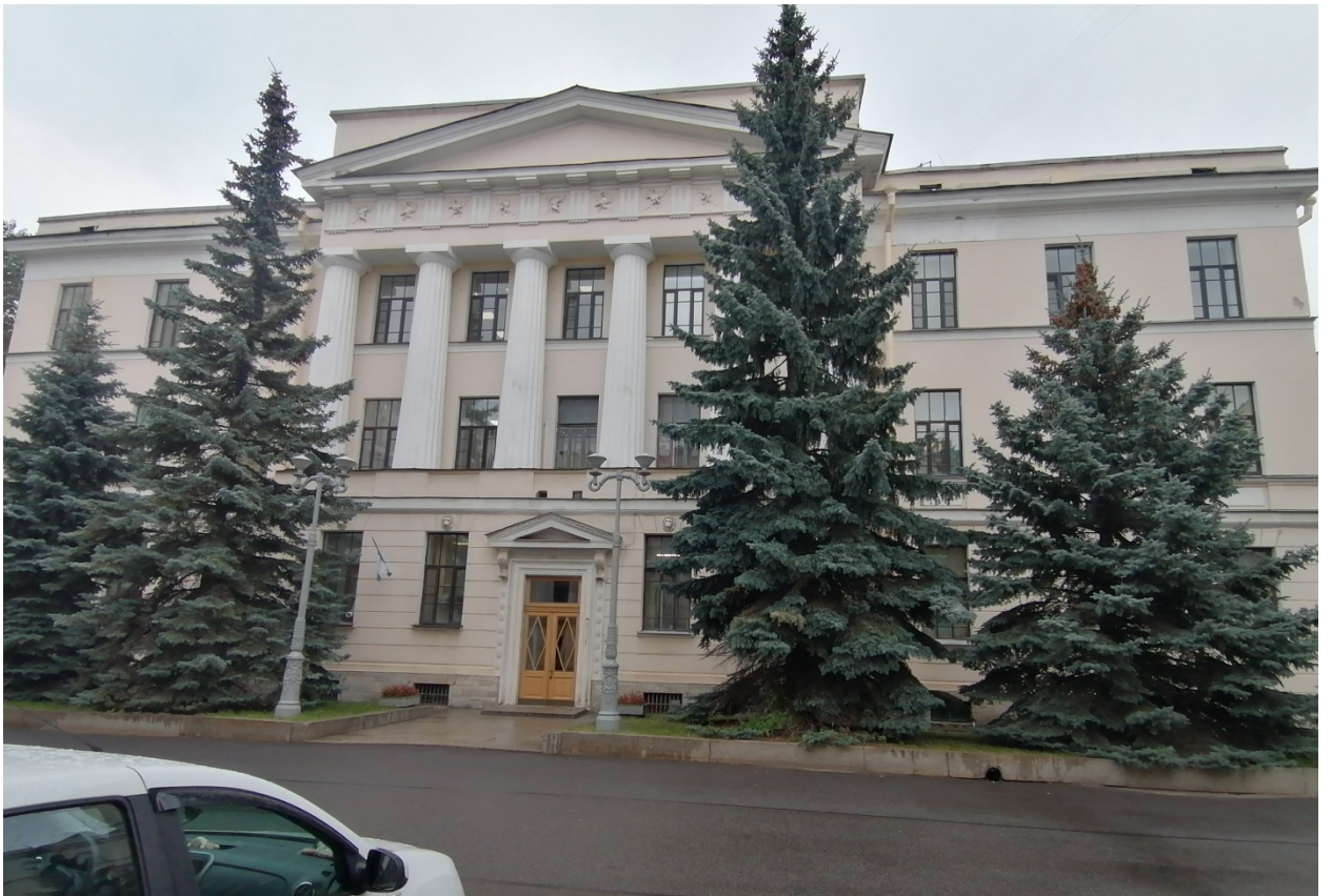
1. Главный фасад (южный). Общий вид.
