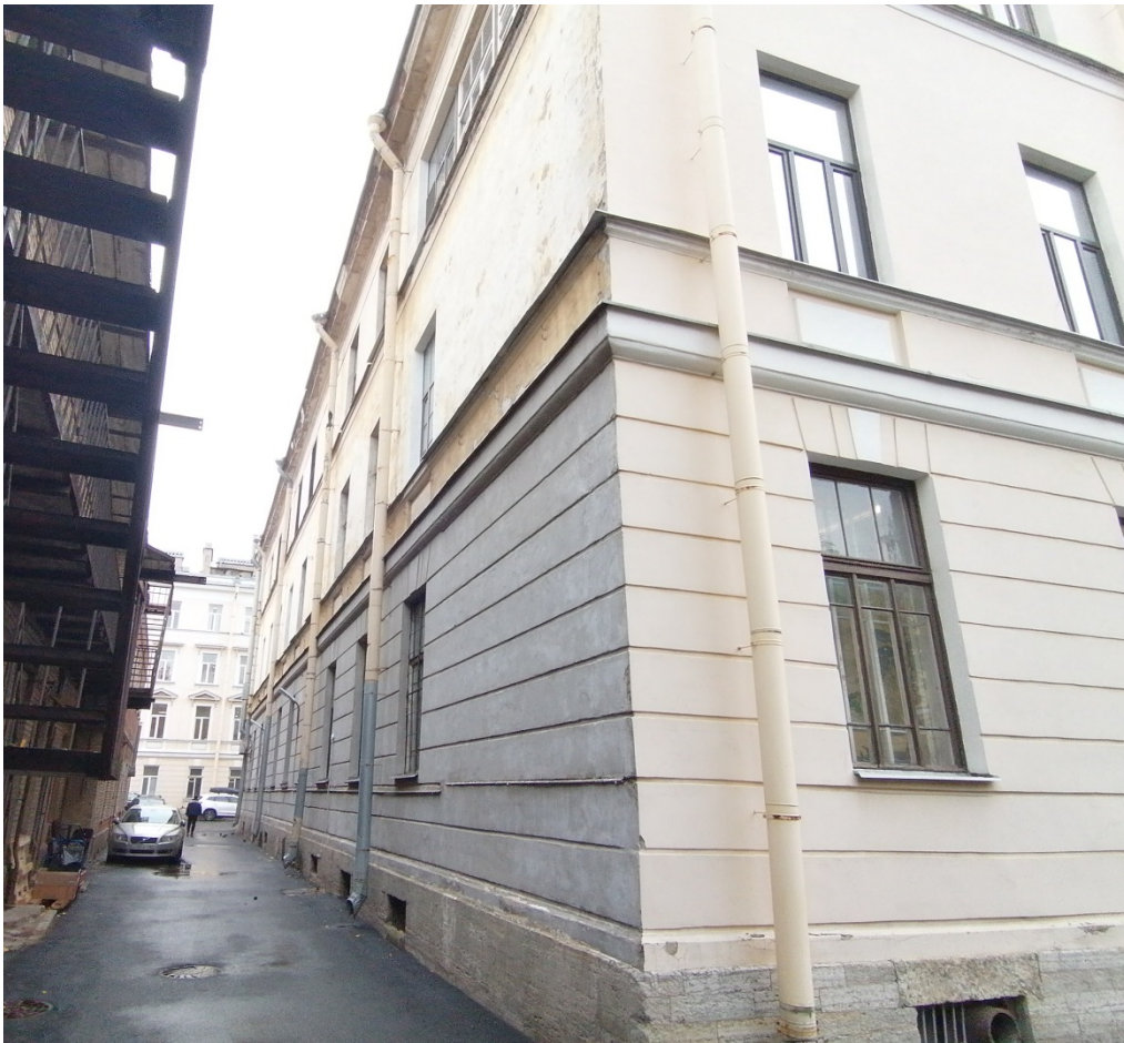
7. Северный фасад. Направление съемки – З-В.
