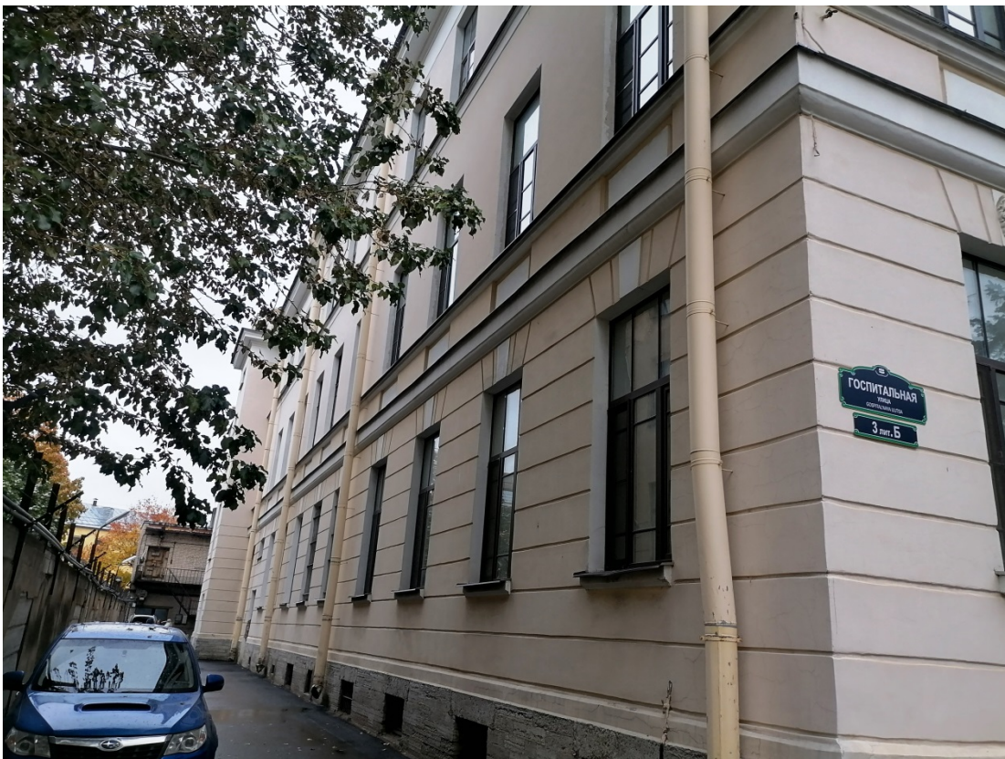
8. Боковой фасад (западный). Общий вид. Направление съемки - Ю-С.
