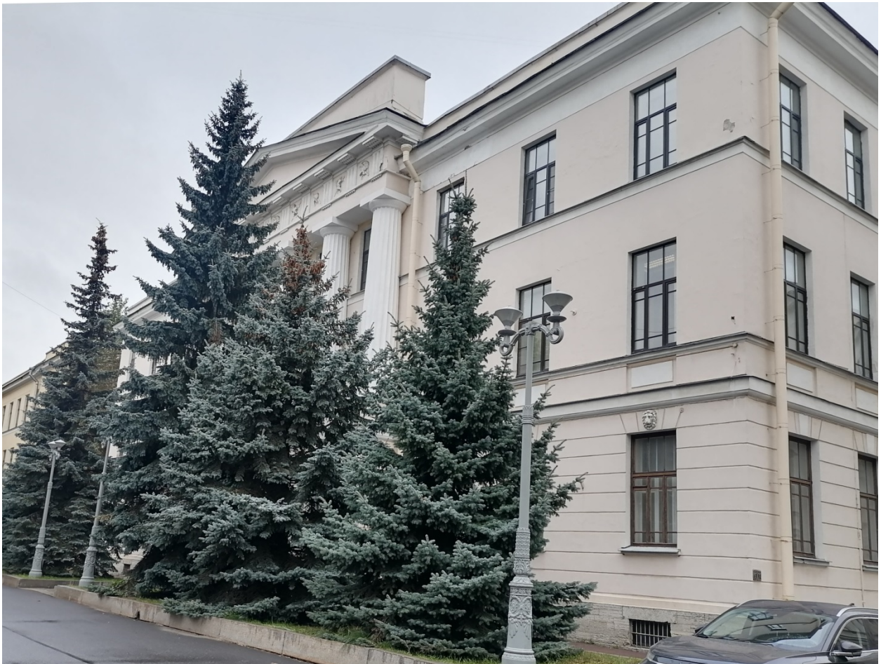
2. Главный фасад (южный). Вид с востока.
