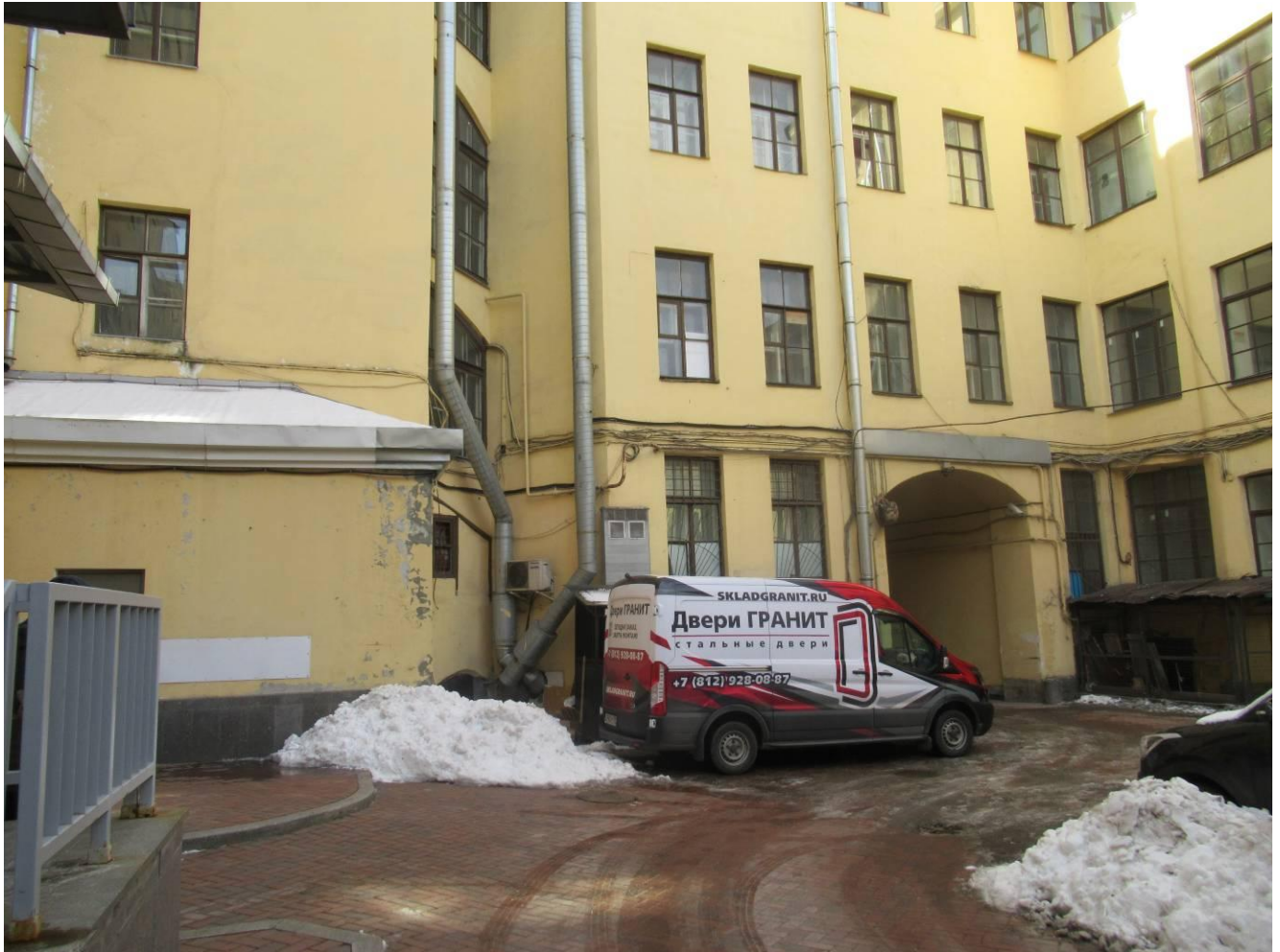
9. Фрагмент дворового (восточного) фасада здания.
