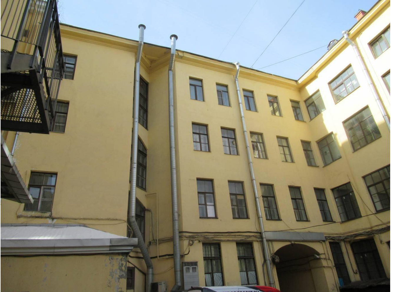
8. Дворовый (восточный) фасад здания. Фрагмент.
