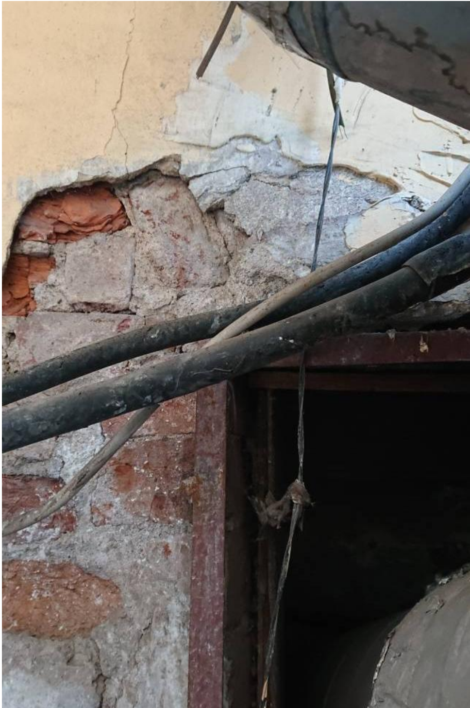
11. Фрагмент проема из помещения 16-Н с клинчатой перемычкой (на историческом плане проем обозначен нишей).
