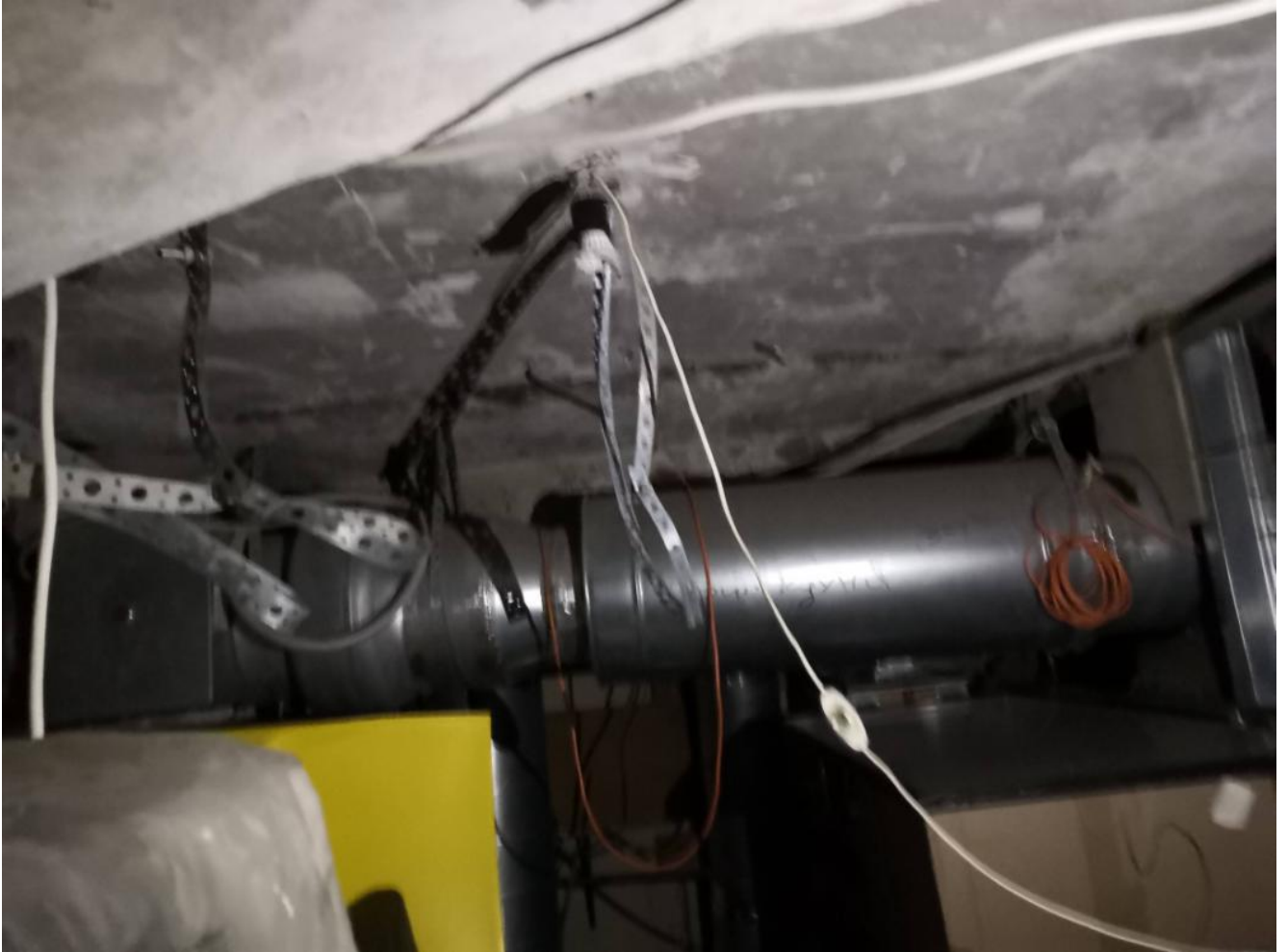
18. Помещение 16-Н. Фрагмент.
