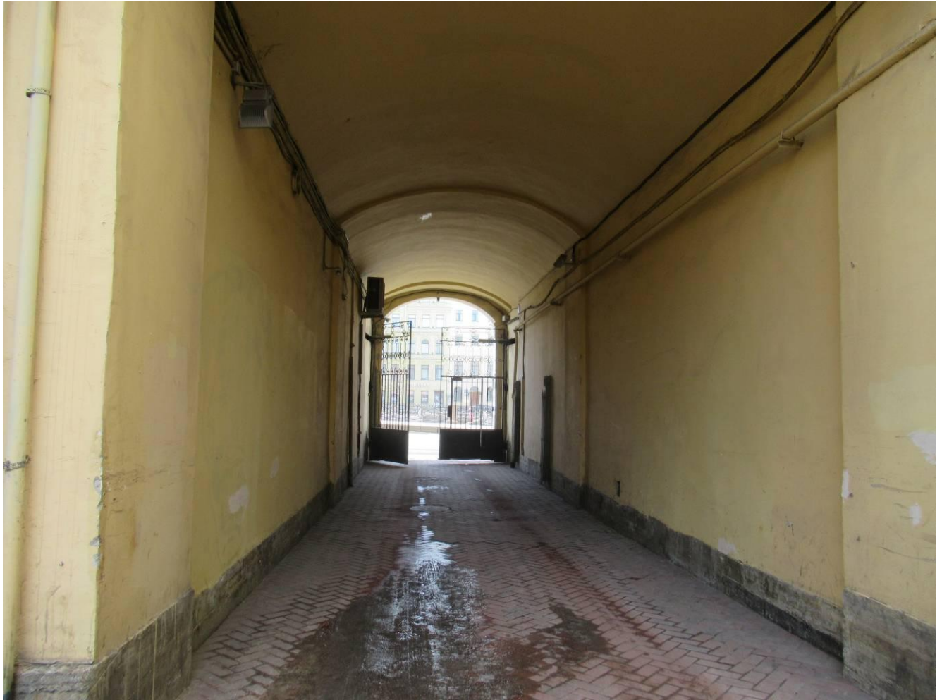
7. Арочный проезд во двор. Вид со стороны дворовой территории.
