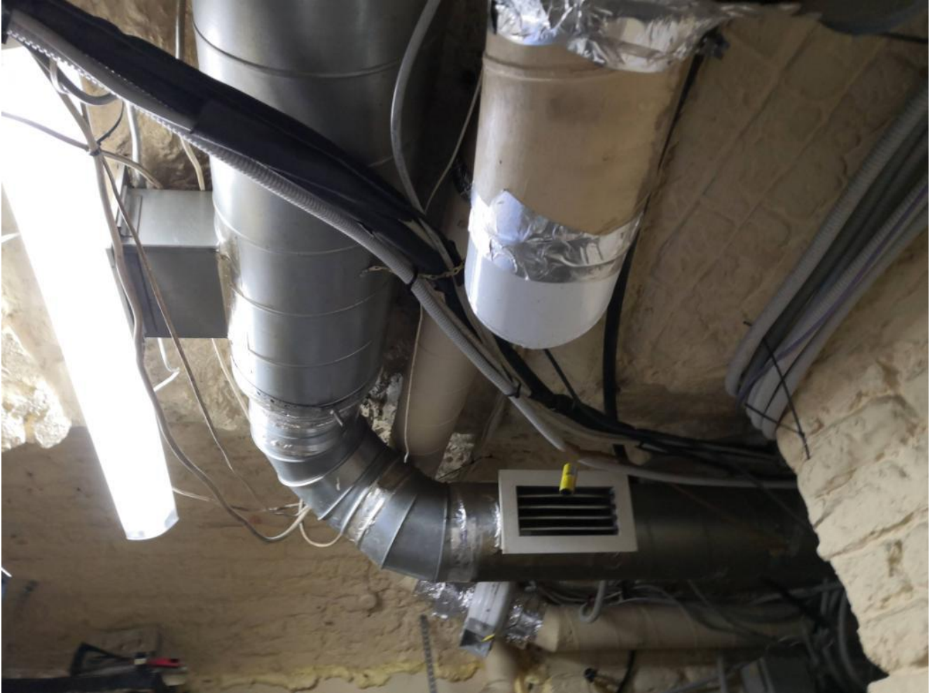
17. Помещение 30-Н. Фрагмент.
