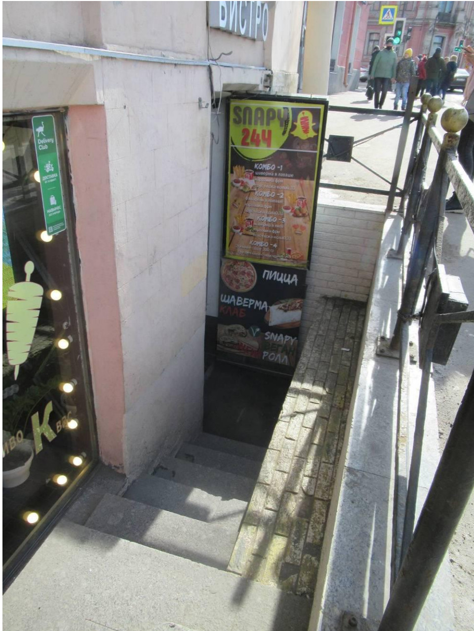
13. Фрагмент приямка с входом в помещение 30-Н.
