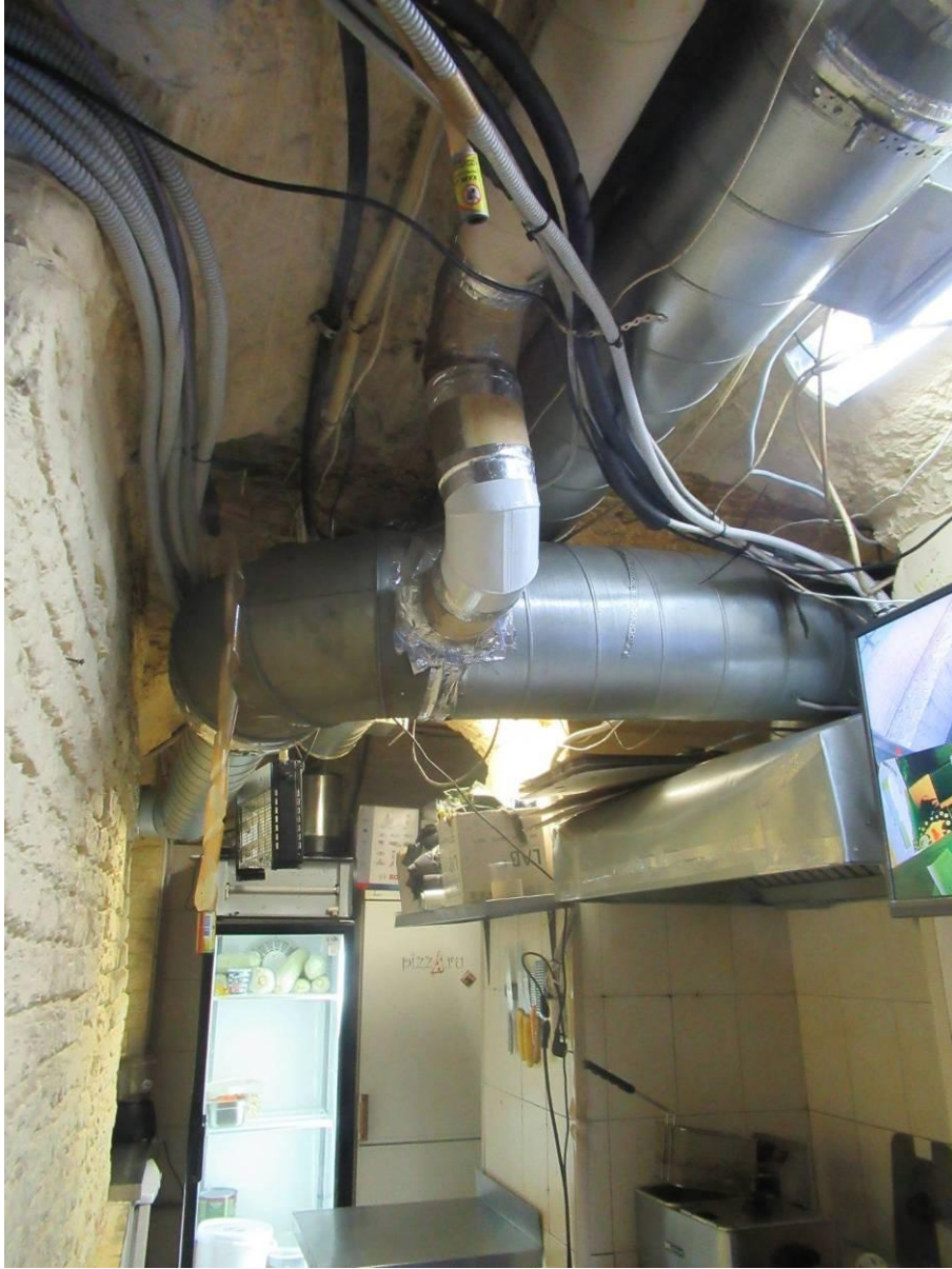
15. Помещение 30-Н. Фрагмент.
