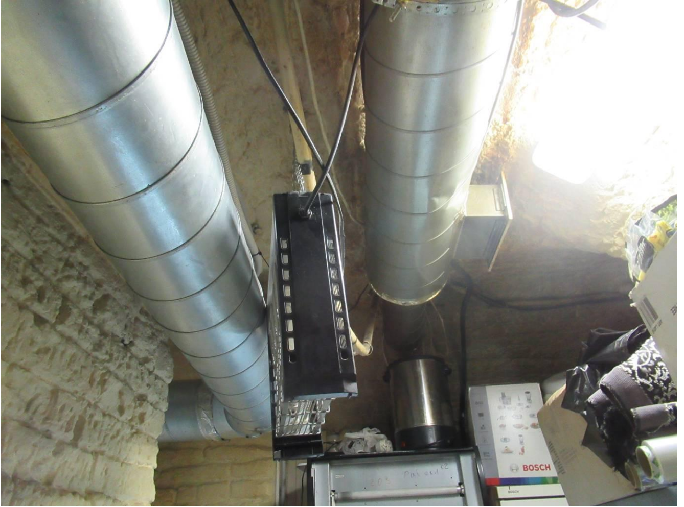
16. Помещение 30-Н. Фрагмент.
