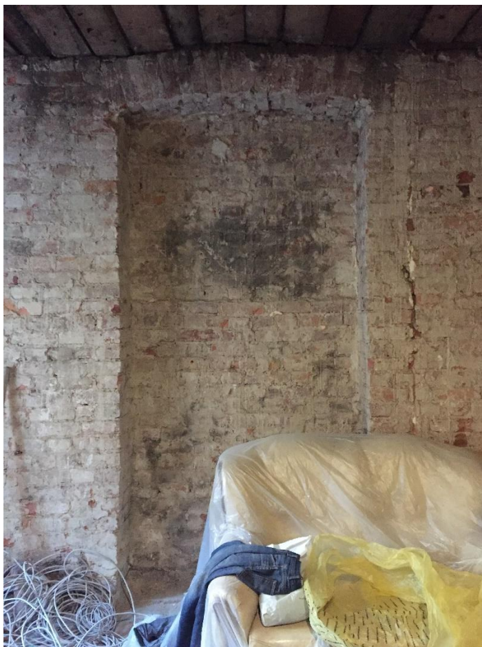
Фото 11. Существующая историческая ниша в капитальной стене.
