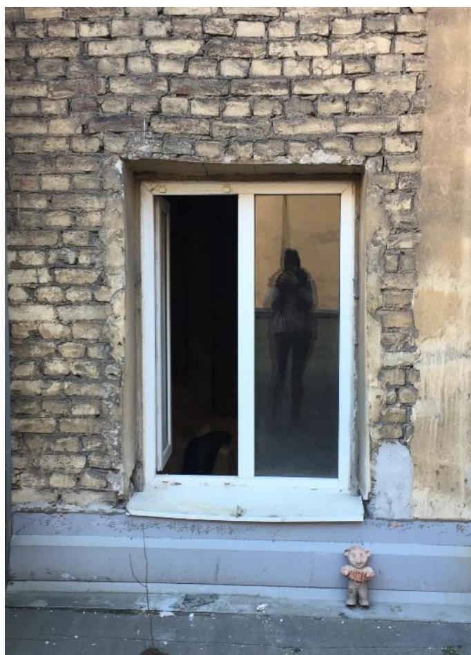
Фото 14. Оконное заполнение квартиры, выходящее на северо-запад.
