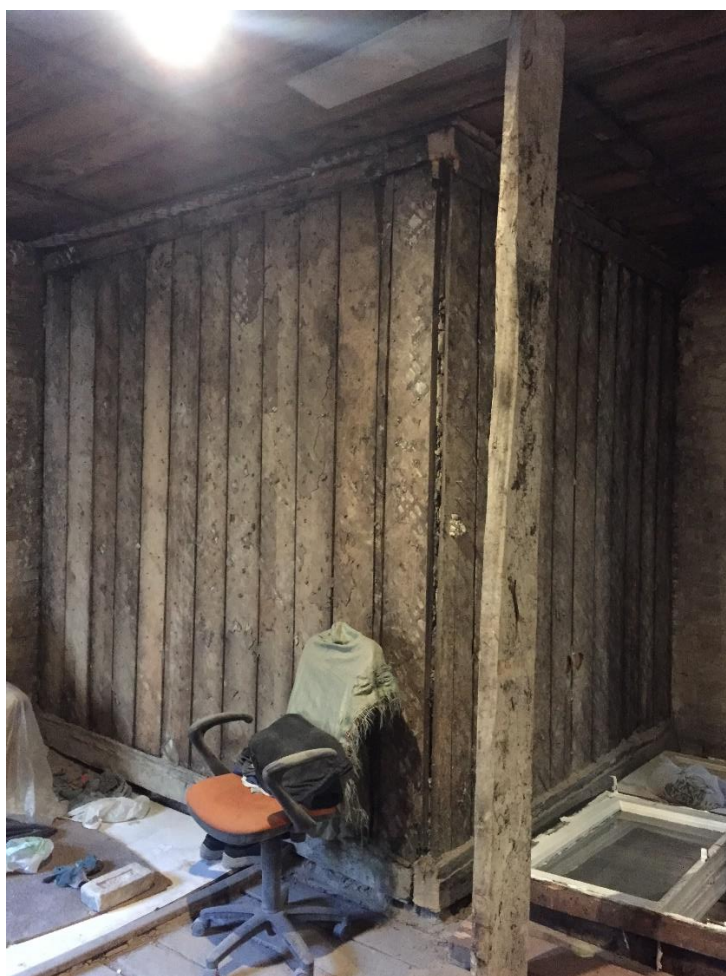
Фото 8. Существующая межквартирная деревянная перегородка.
