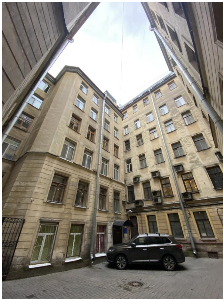
Фото 3. Северо-западный и юго-западный дворовые фасады лицевого корпуса.
