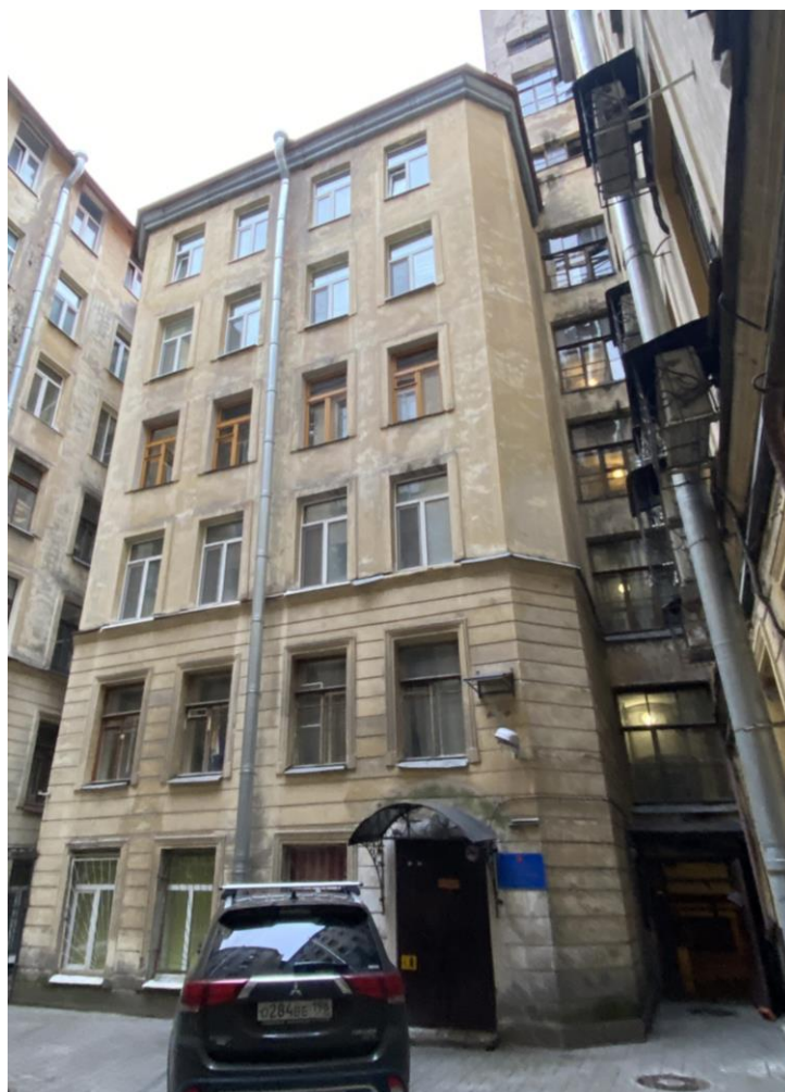
Фото 4. Юго-западный дворовой фасад.
