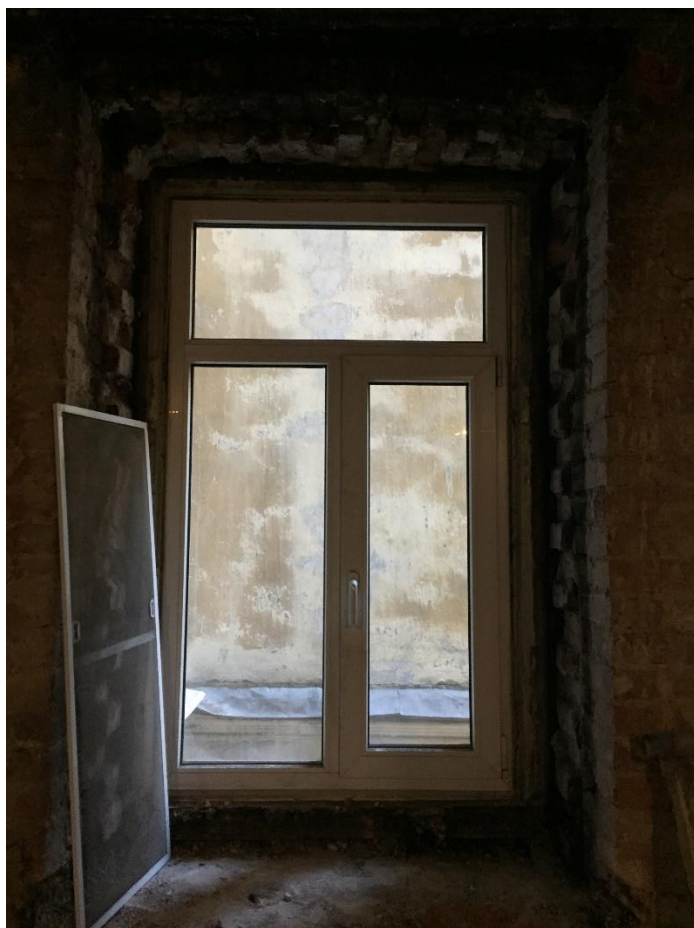
Фото 13. Существующее оконное заполнение квартиры, выходящее на северо-запад.
