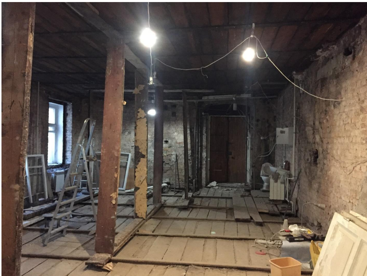
Фото 9. Общий вид существующего состояния помещений квартиры № 78.
