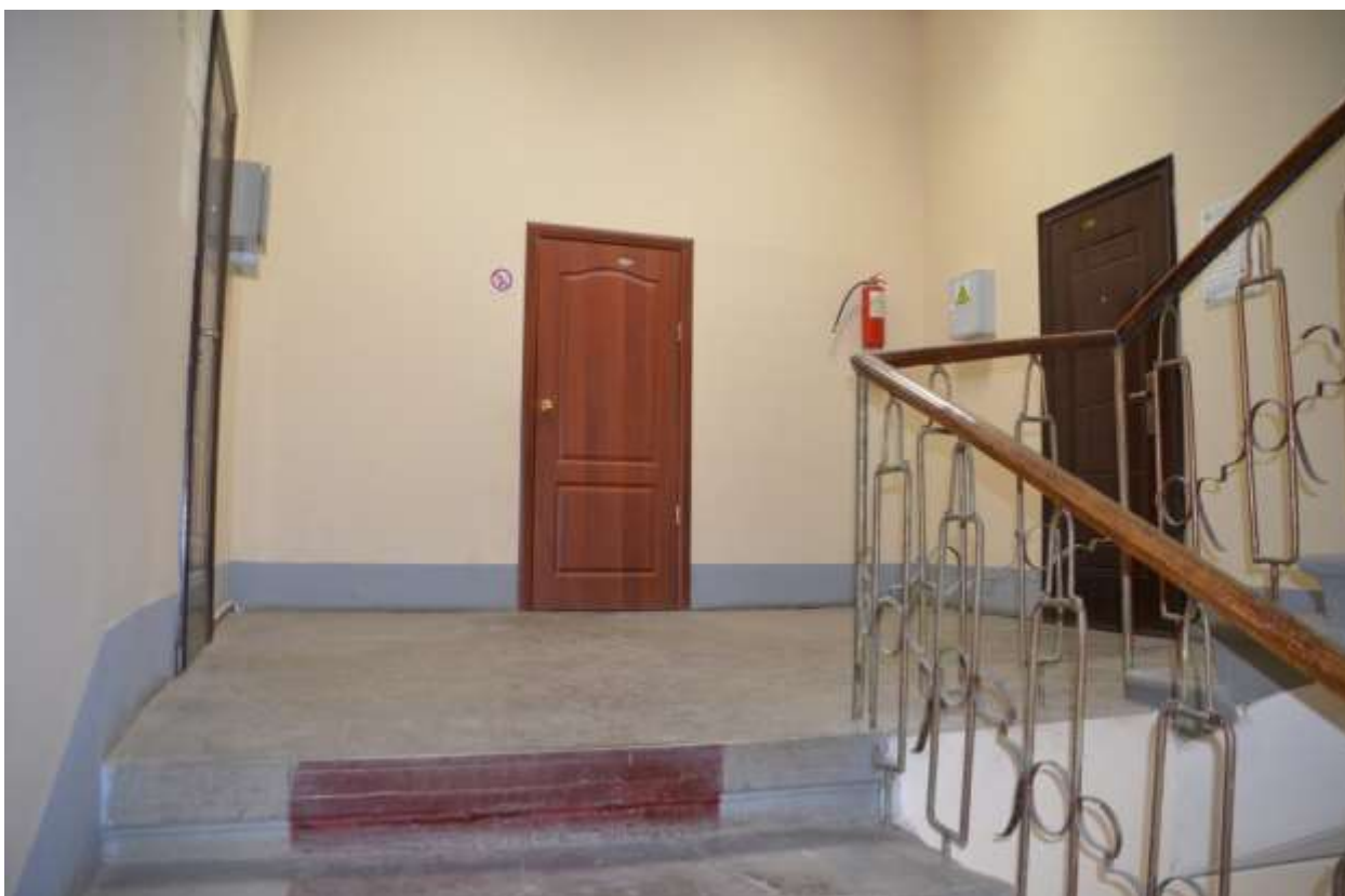
Фото 17. Общий вид площадки 2-го этажа северной парадной.
