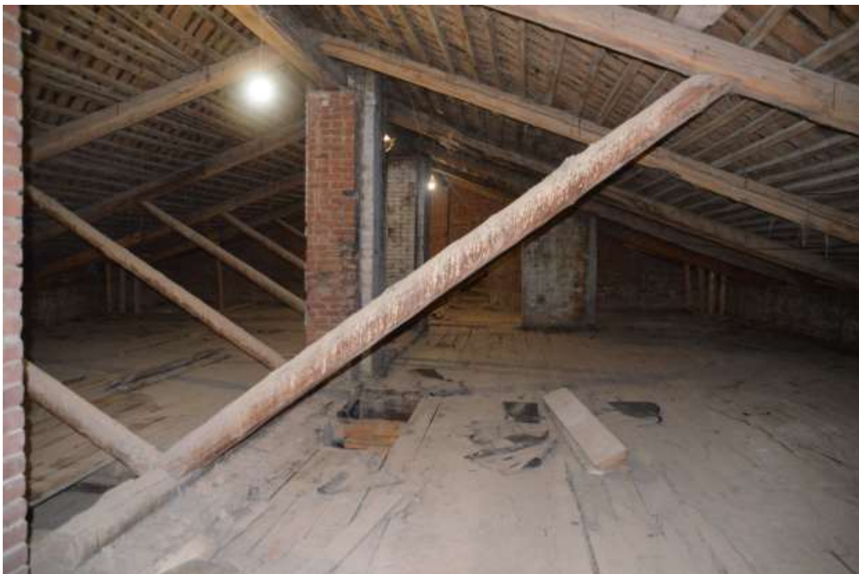
Фото 23. Вид чердака и конструкций крыши.
