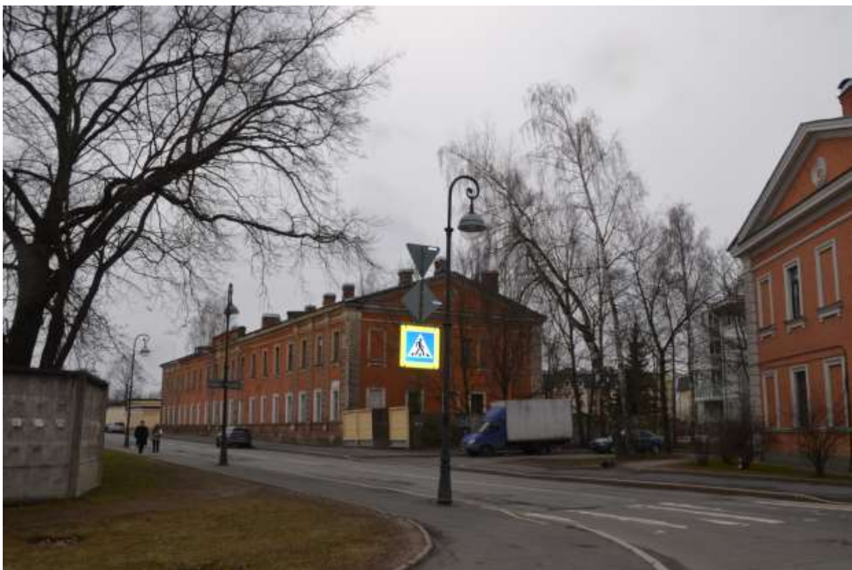
Фото 01. Вид на северный и восточный фасады со стороны Парковой ул.
