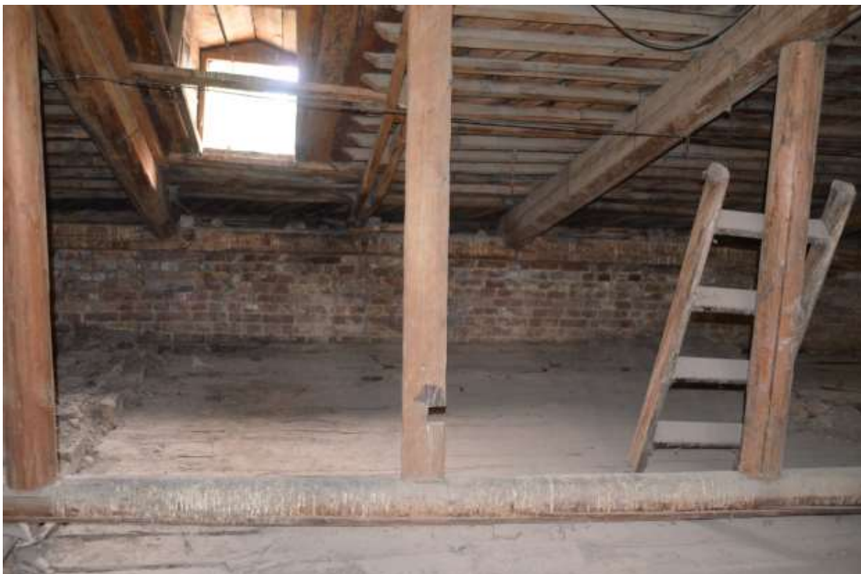
Фото 21. Вид чердака, выхода на крышу и конструкций крыши.
