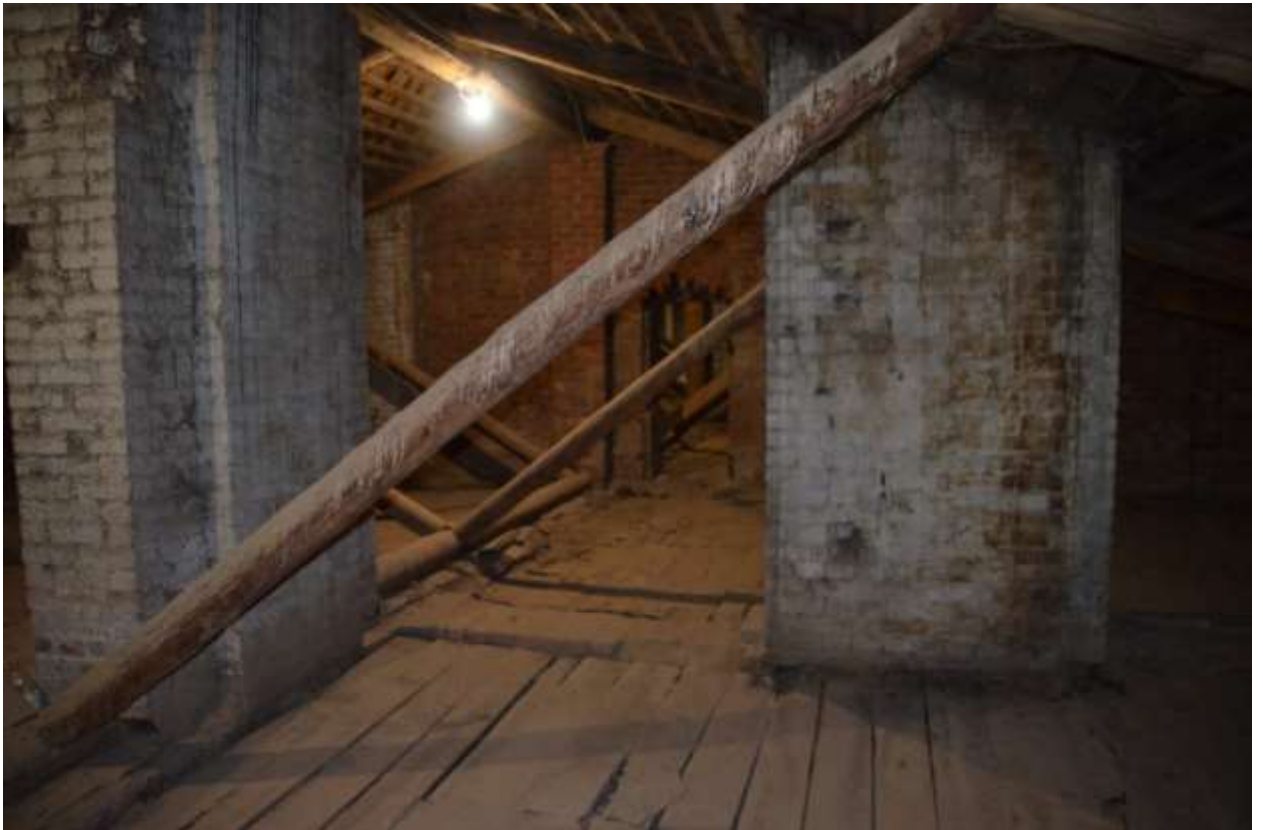
Фото 24. Вид чердака и конструкций крыши.
