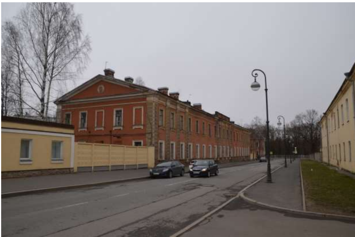
Фото 04. Вид на восточный и южный фасады со стороны Гусарской ул.
