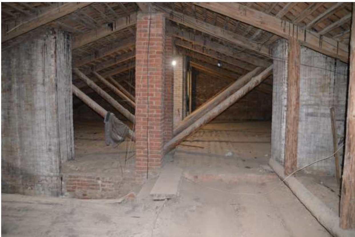
Фото 26. Вид чердака и конструкций крыши.
