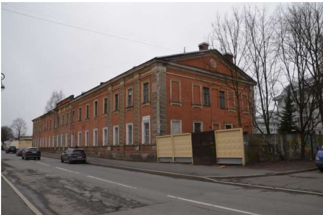
Фото 02. Вид на северный и восточный фасады со стороны Парковой ул.
