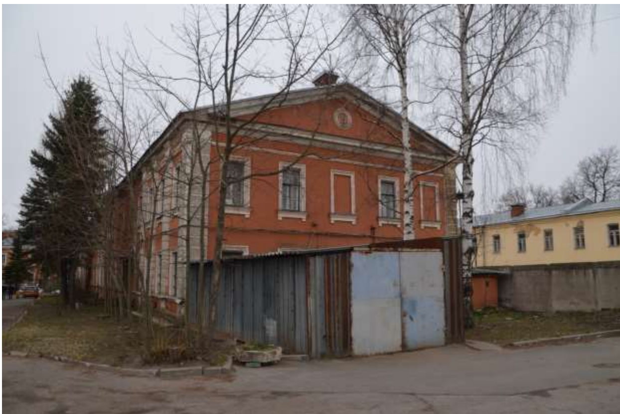
Фото 05. Вид на южный фасад со стороны Колокольного пер.
