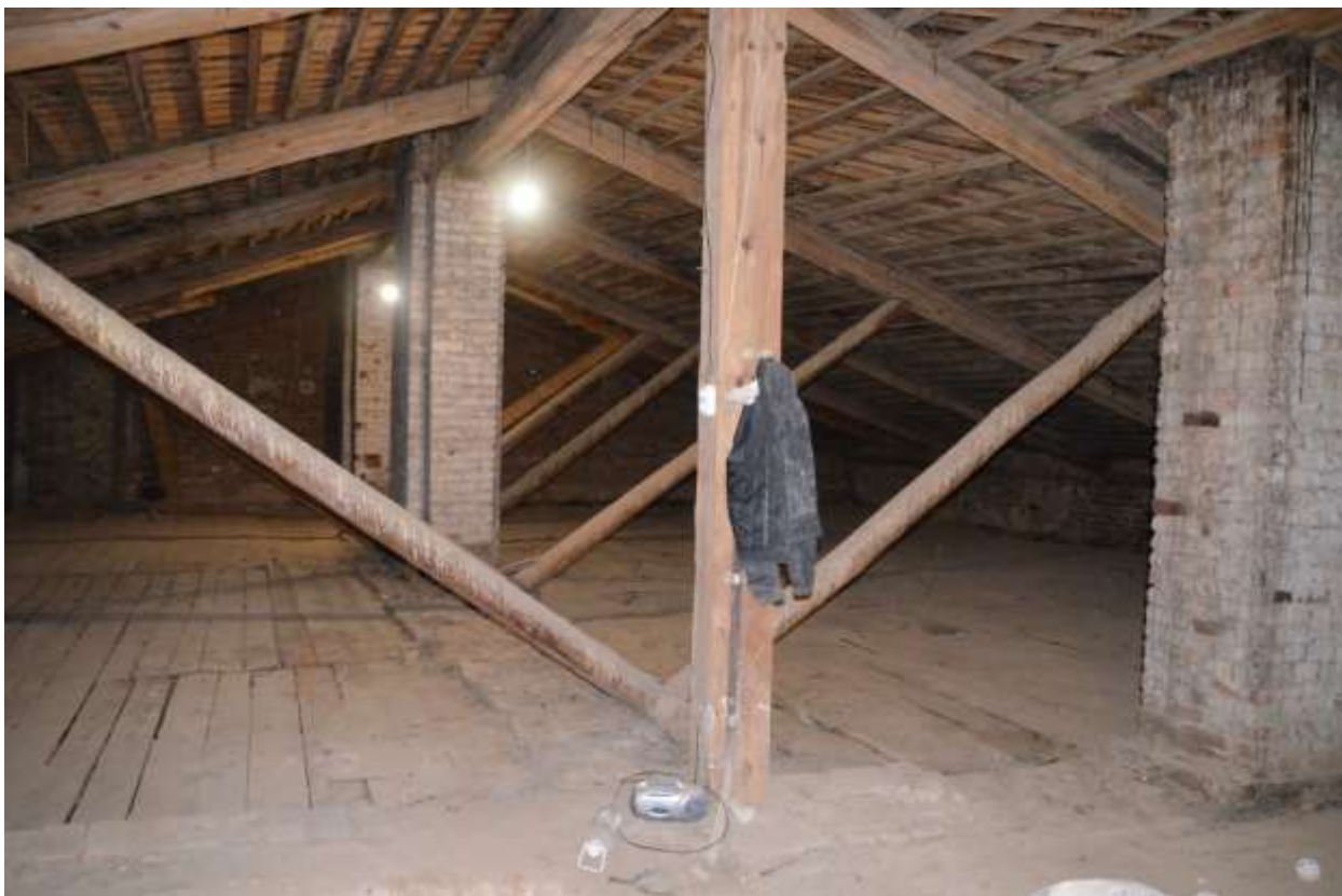
Фото 22. Вид чердака и конструкций крыши.
