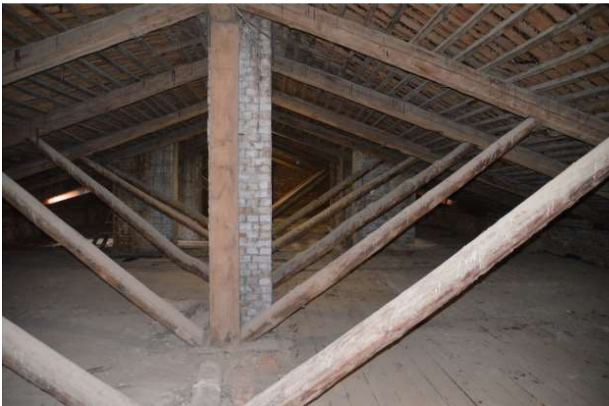
Фото 25. Вид чердака и конструкций крыши.
