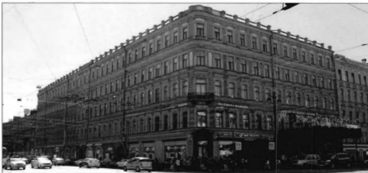
ФОТО №1. Лицевые фасады (северный и восточный) со стороны Невского проспекта.
