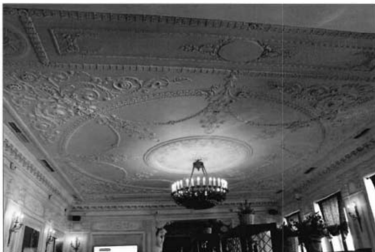
Фото №3, 4. Помещение 58-Н (1) 2-го этажа.
