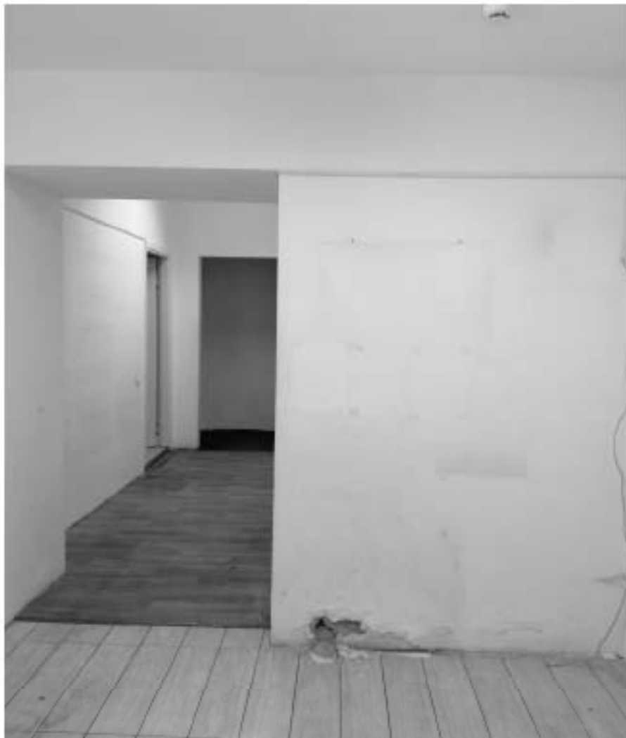
Фото 20. Объект культурного наследия регионального значения «Здание, где размещался ресторан "К.П.Палкин"», расположенный по адресу г. Санкт-Петербург, Владимирский проспект, дом 1/47, литера Б. Помещение 5-Н (14).
