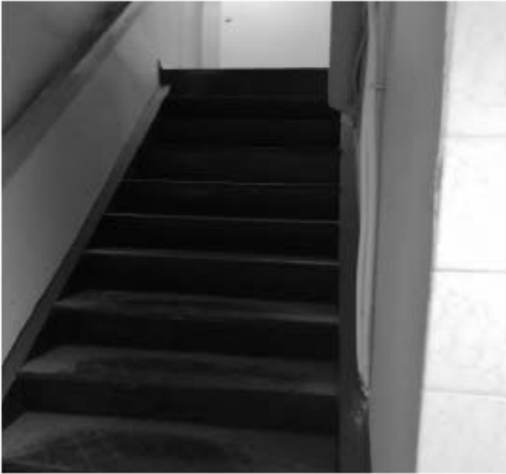
Фото 12. Объект культурного наследия регионального значения «Здание, где размещался ресторан "К.П.Палкин", расположенный по адресу г. Санкт-Петербург, Владимирский проспект, дом 1/47, литера Б. Помещение 5-Н (16). Лестница на антресоль.
