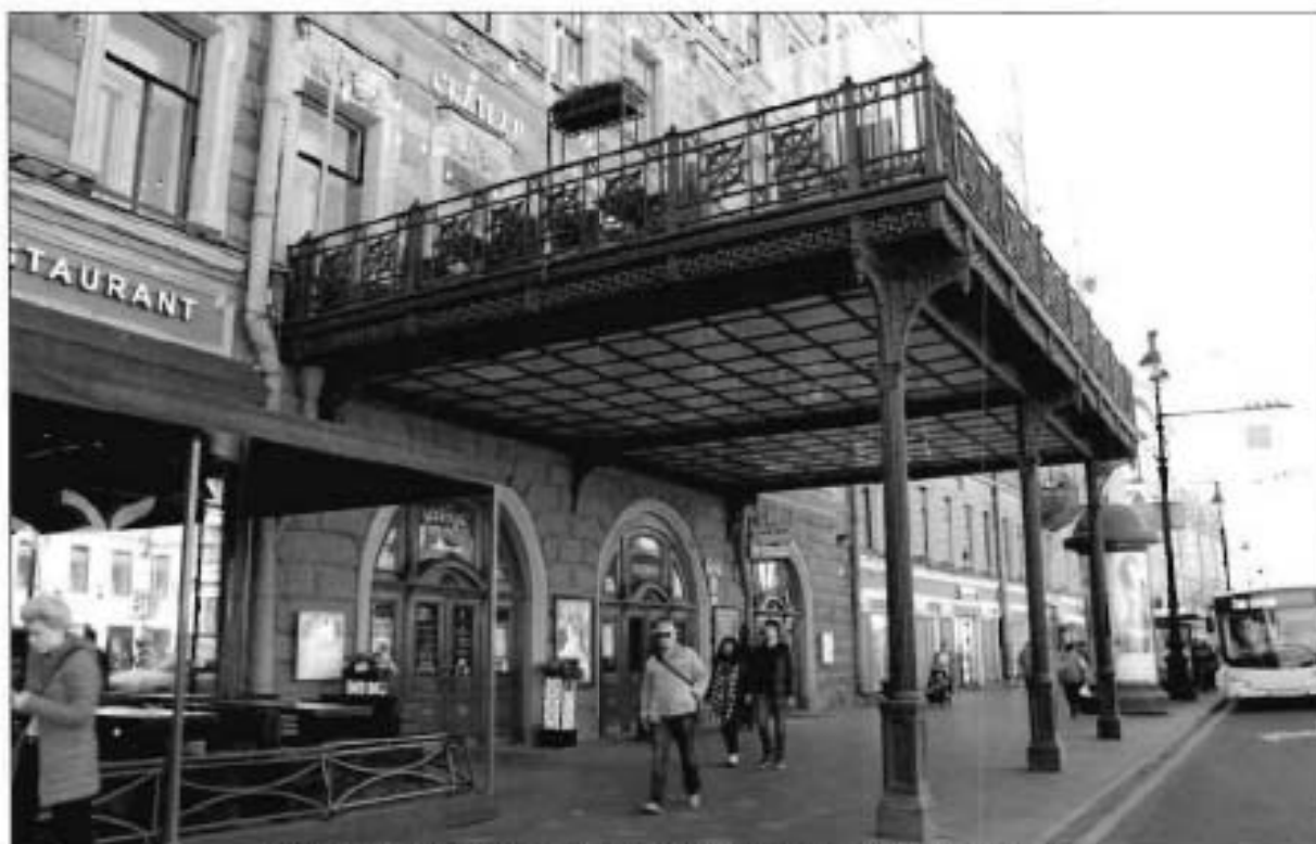
ФОТО №2. Выходной балкон на столбах по Невскому проспекту.
