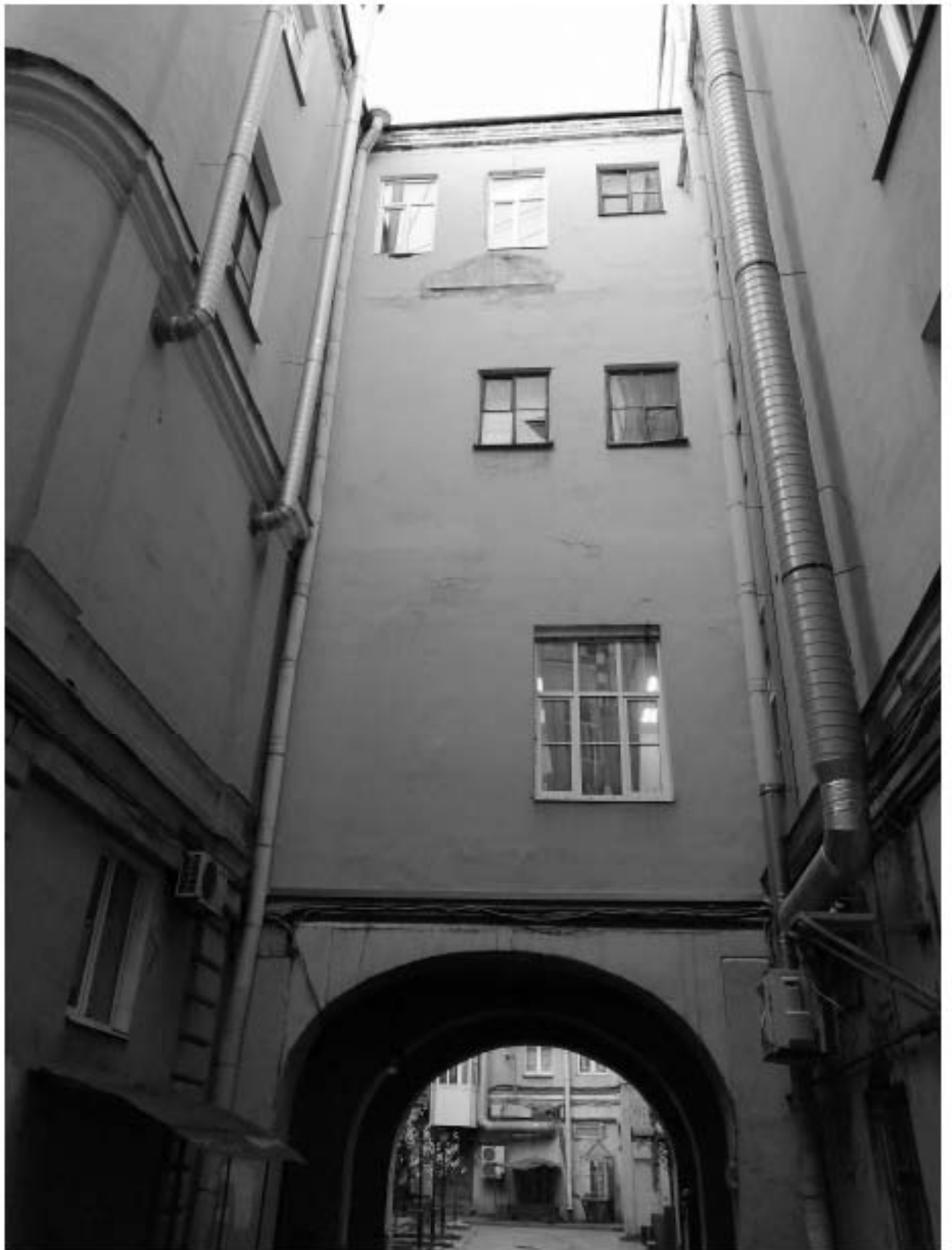
Фото 7. Объект культурного наследия регионального значения «Здание, где размещался ресторан "К.П.Палкин", расположенный по адресу г. Санкт-Петербург, Владимирский проспект, дом 1/47, литера Б. Арочный воротный проезд в дворовом флигеле между дворами.
