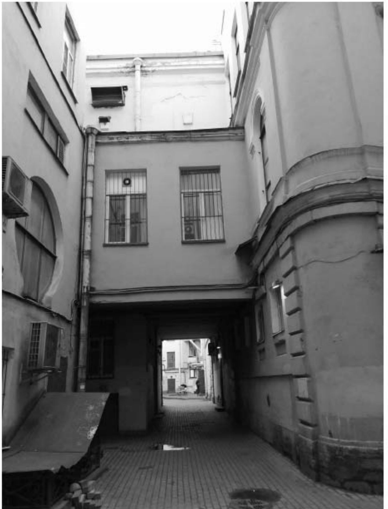
Фото 6. Объект культурного наследия регионального значения «Здание, где размещался ресторан "К.П.Палкин", расположенный по адресу г. Санкт-Петербург, Владимирский проспект, дом 1/47, литера Б. Северный дворовый фасад. Общий вид.
