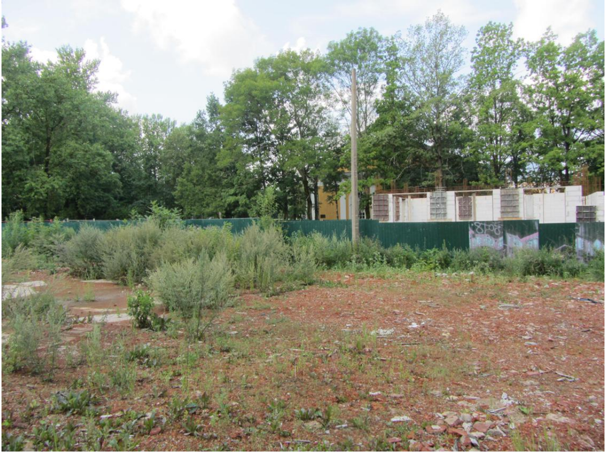
13. Выявленный объект культурного наследия «Служебное здание». Общий вид участка.
