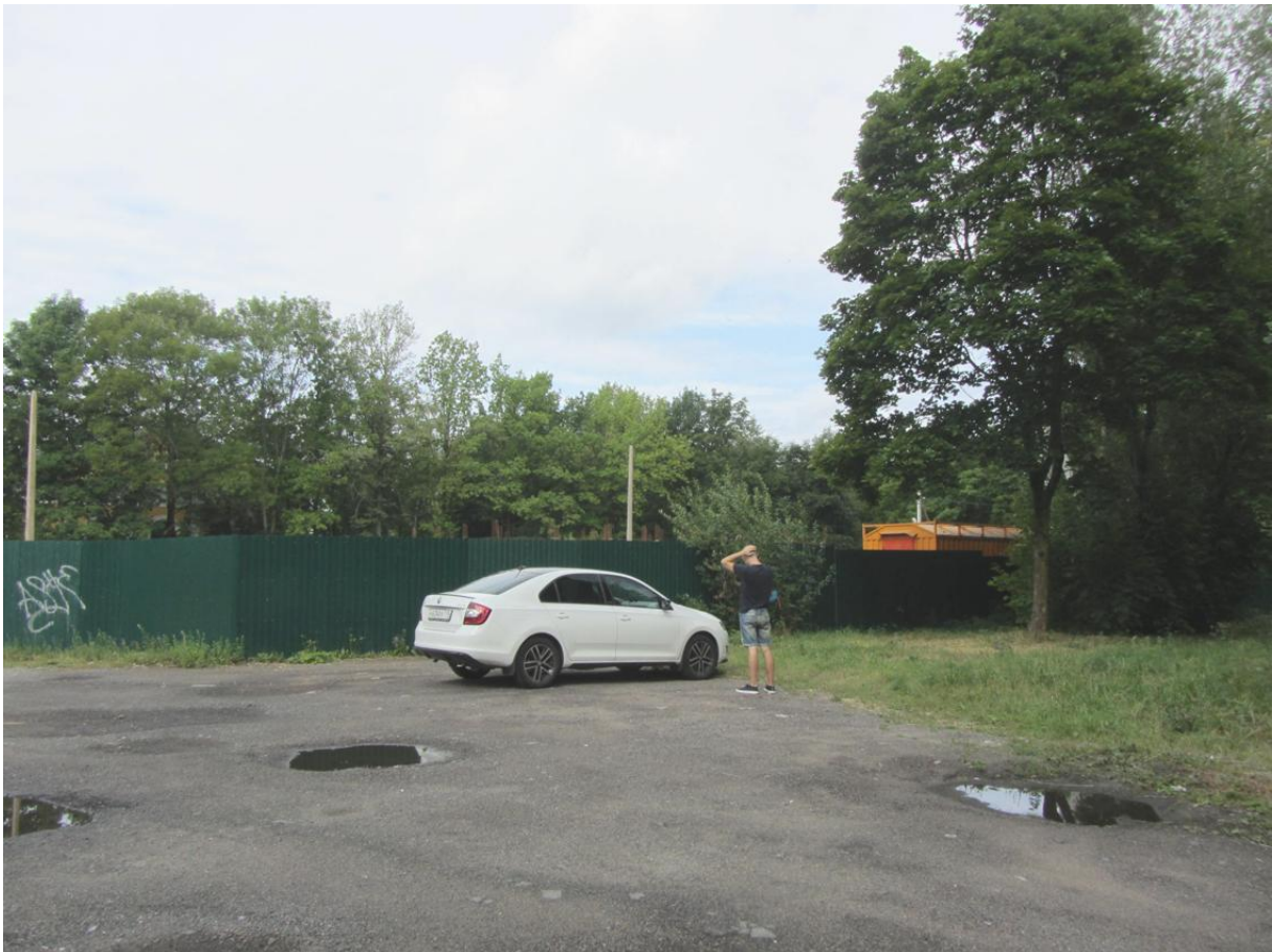
7. Выявленный объект культурного наследия «Службное здание». Общий вид.
