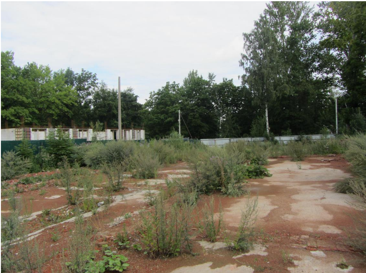
14. Выявленный объект культурного наследия «Служебное здание». Общий вид участка.
