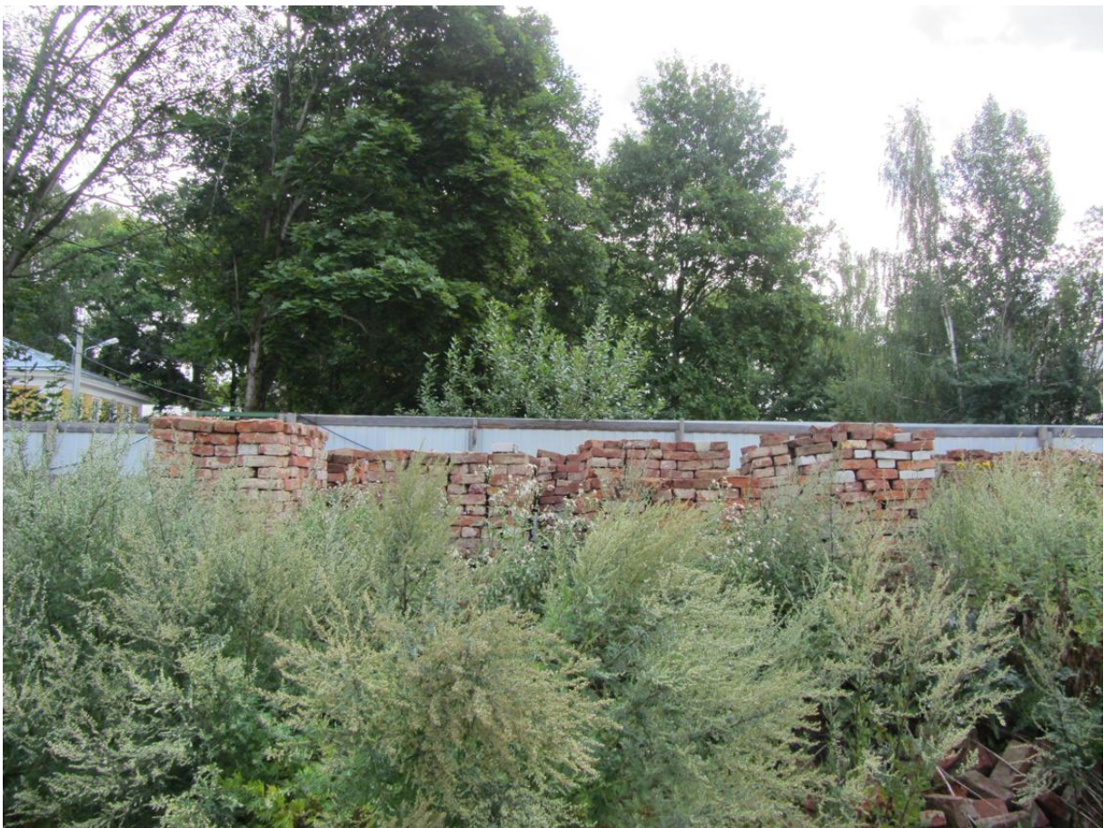
16. Выявленный объект культурного наследия «Служебное здание». Общий вид участка в сторону Михайловской улицы.
