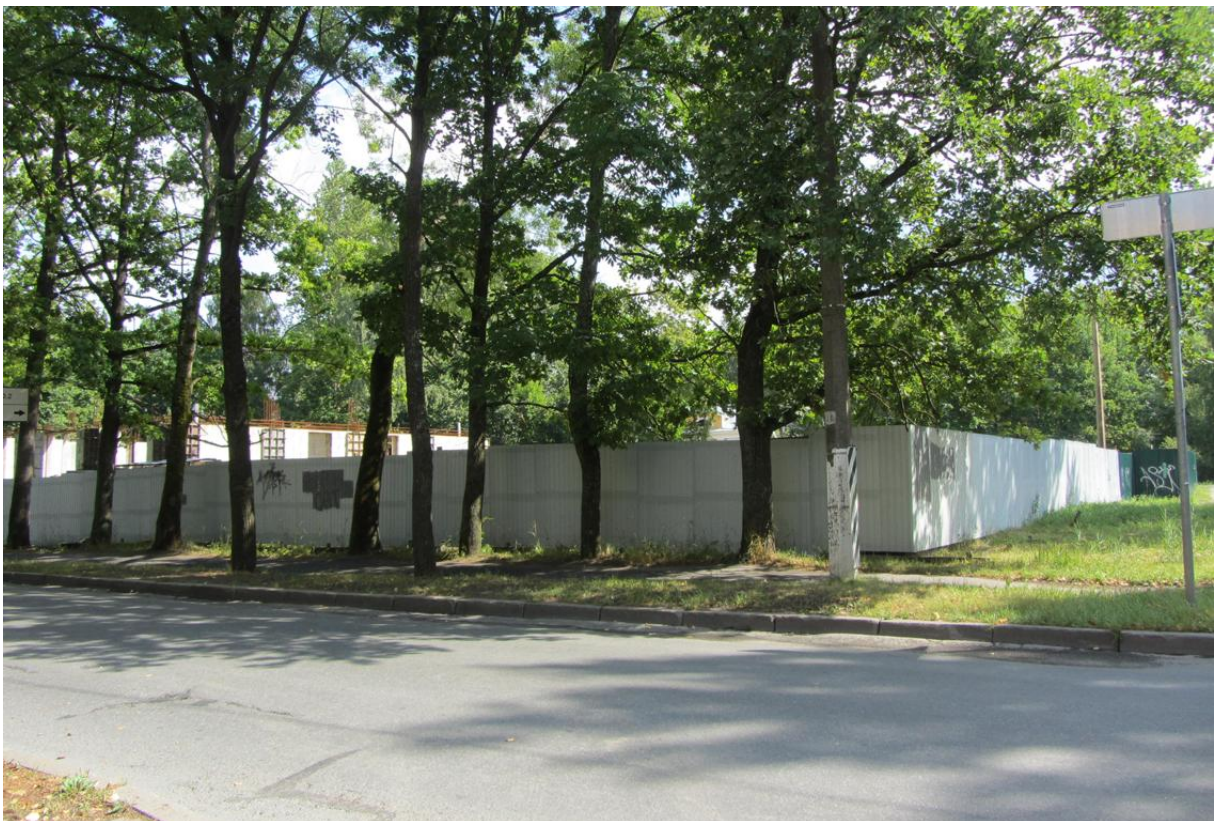
3. Выявленный объект культурного наследия «Служебное здание». Общий вид с Манежной улицы от здания Экзерциргауза лейб-гвардии Волынского полка.
