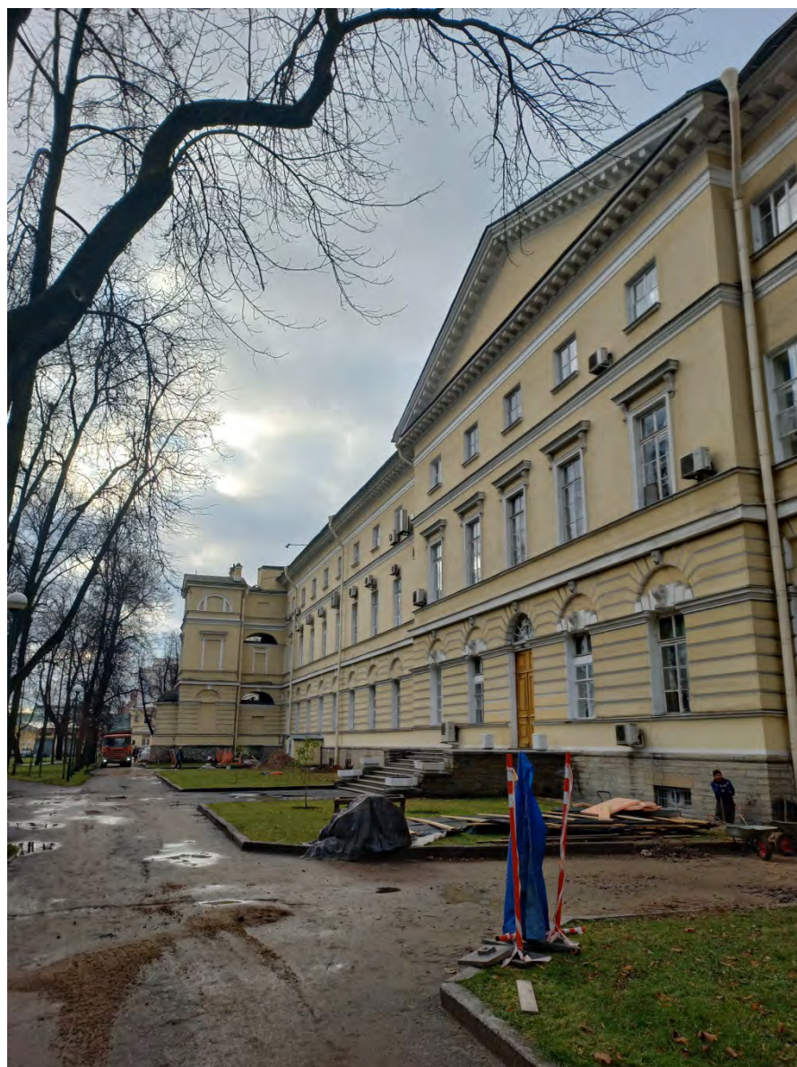
Фото 2. Общий вид фасада. Направление съемки – юго-восток.
