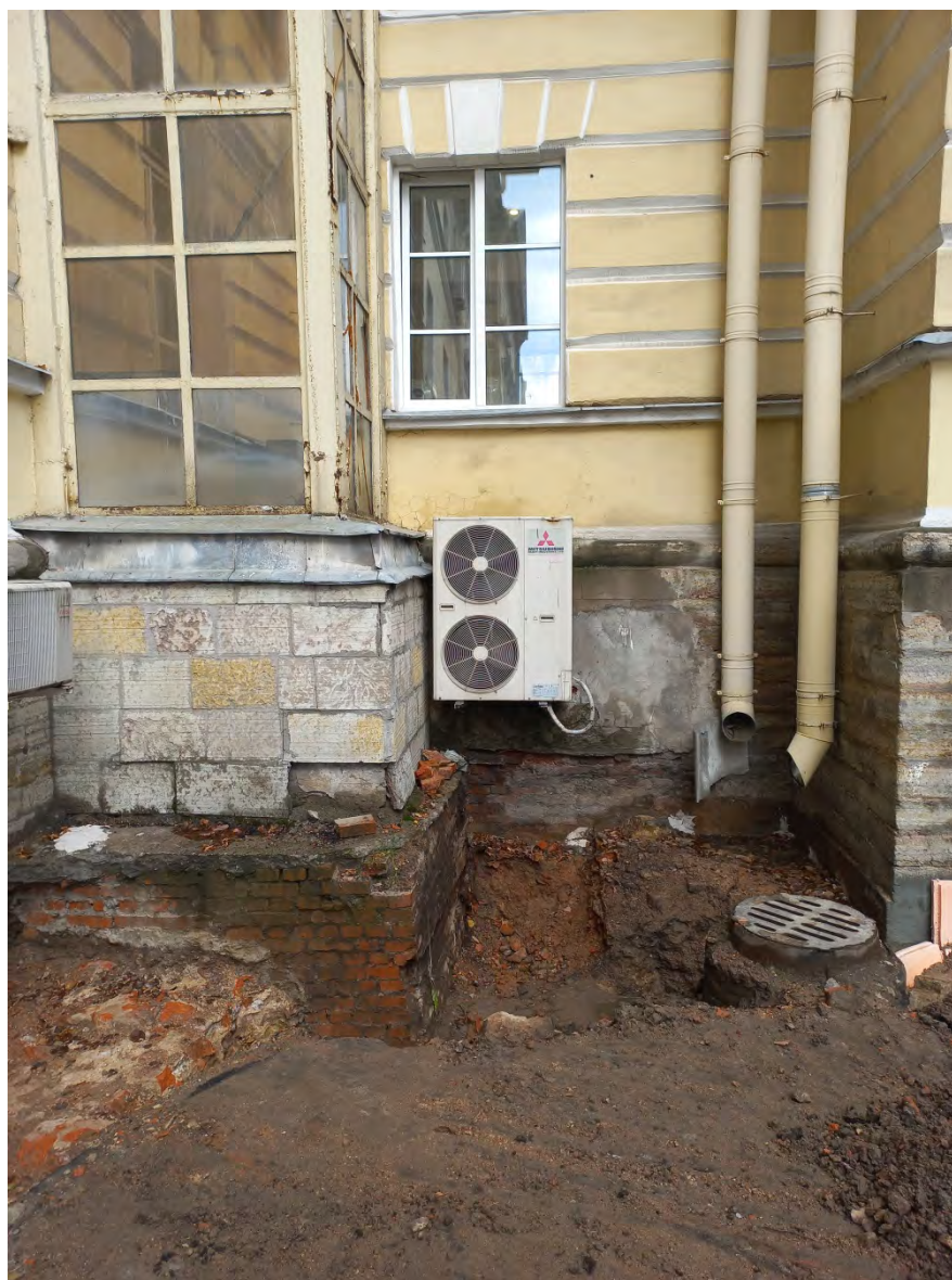
Фото 6. Фундамент северной шахты. Направление съемки – северо-восток.
