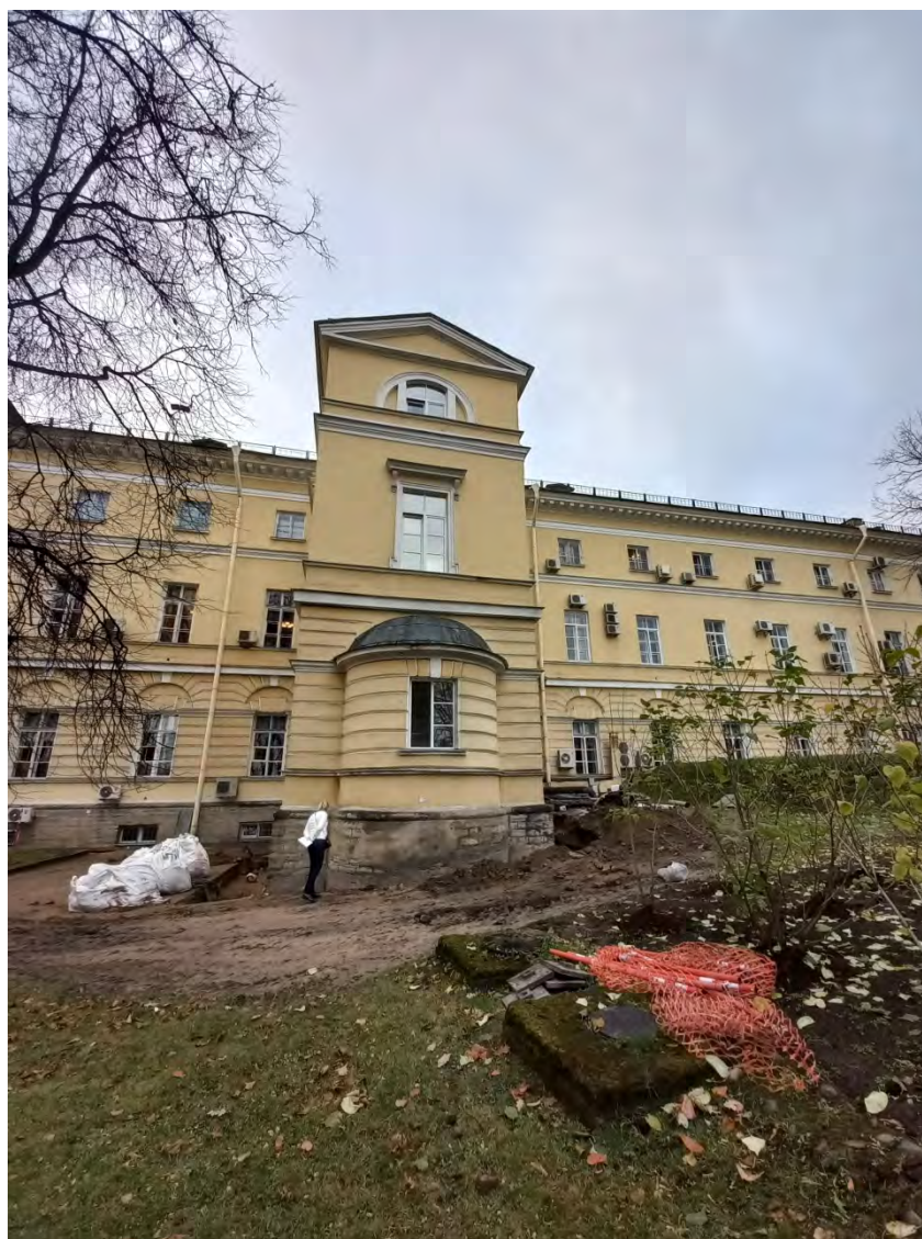
Фото 3. Общий вид фасада. Направление съемки – запад.
