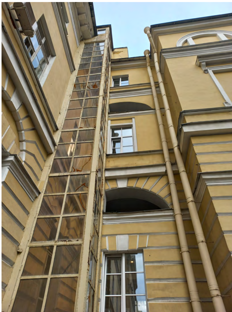
Фото 8. Северная шахта. Направление съемки – северо-восток.
