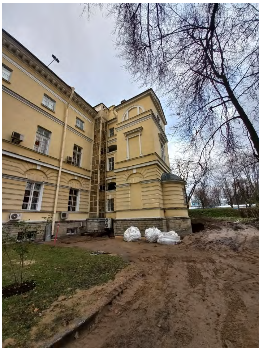
Фото 5. Северная шахта. Направление съемки – северо-восток.
