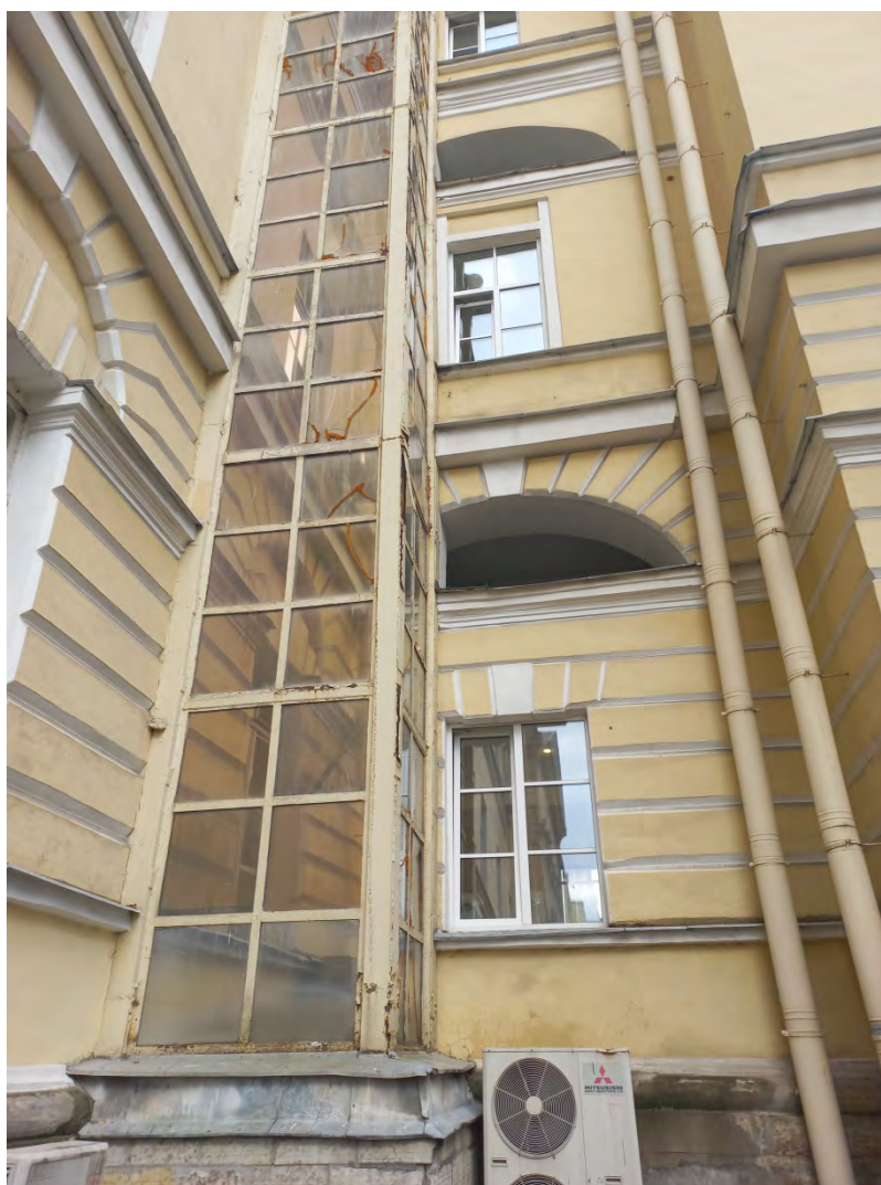
Фото 7. Цоколь и нижняя часть северной шахты. Направление съемки – северо-восток.
