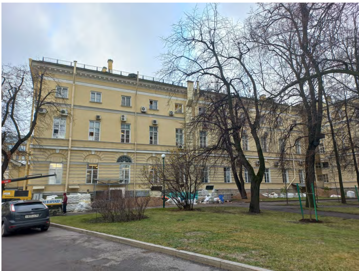
Фото 1. Общий вид фасада. Направление съемки – северо-запад.
