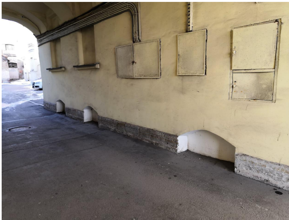
Точка 9 – Фрагмент фасада здания
