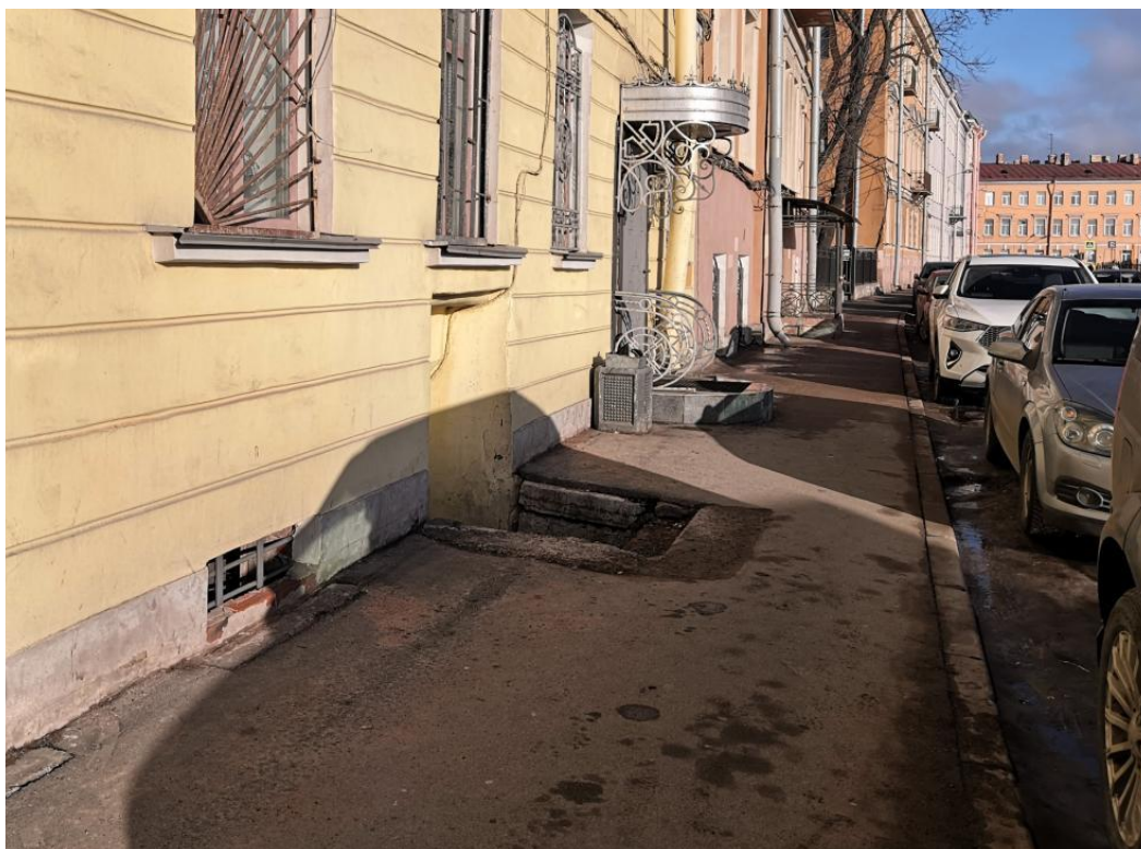
Точка 3 – Фрагмент лицевого фасада здания
