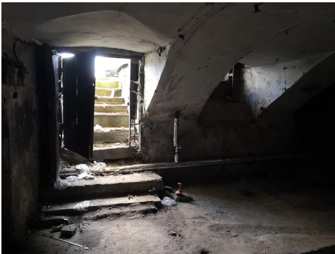
Точка 7 – пом. №2 (дверной проем)
