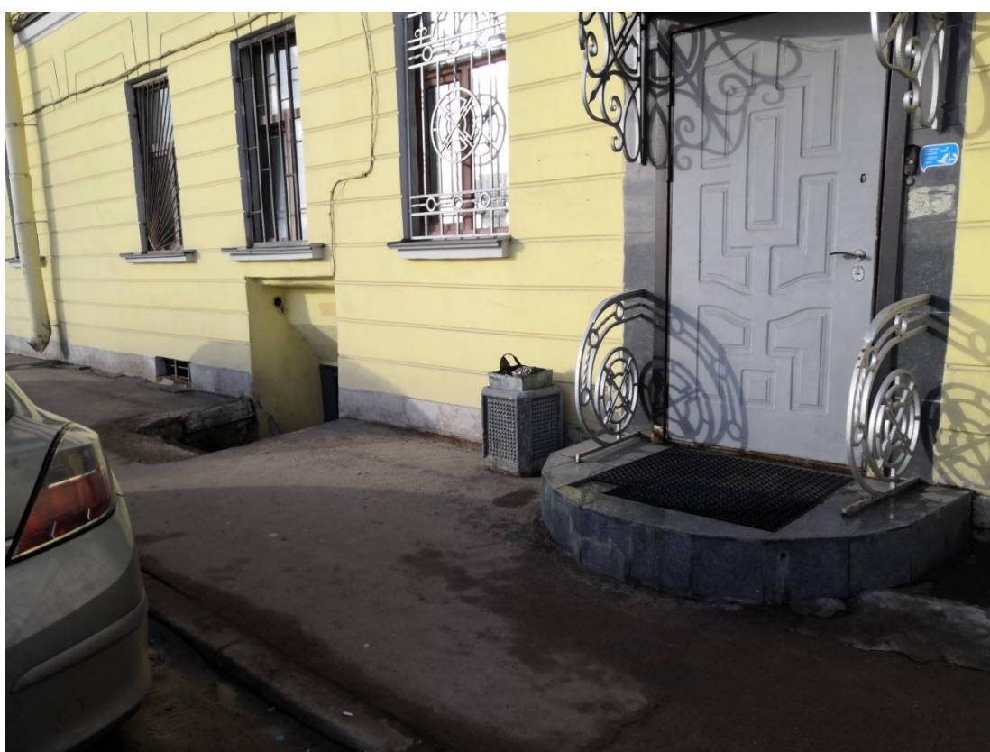
Точка 4 – Фрагмент лицевого фасада здания
