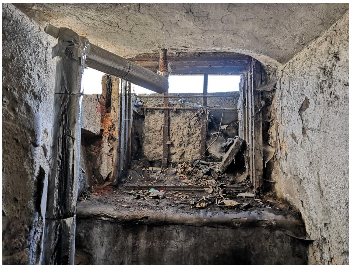
Точка 18 – пом. №1 (существующий оконный проем)
