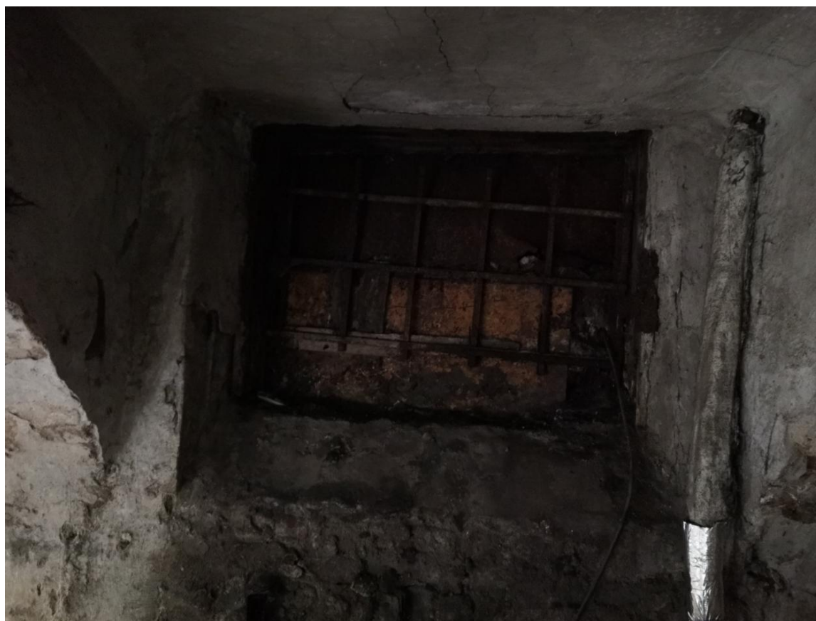
Точка 4 – пом. №2 (заложный со стороны фасад оконный проем)
