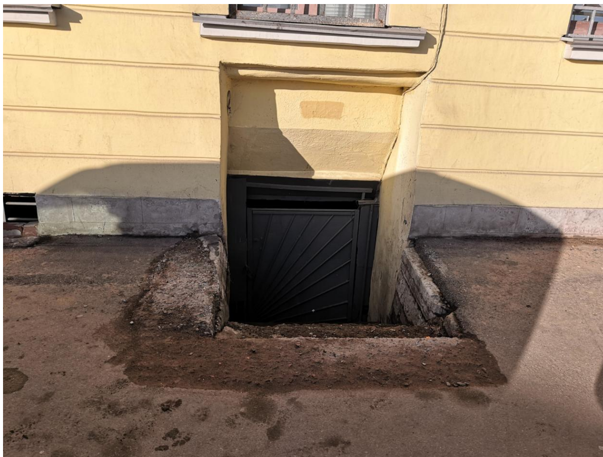
Точка 7 – Фрагмент лицевого фасада здания. Прямок пом. 2-Н
