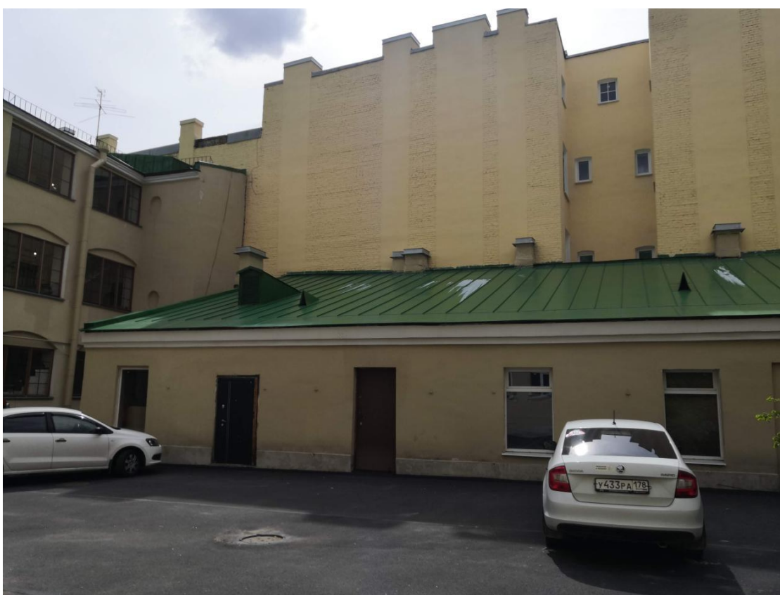
Точка 12 – Общий вид дворового фасада здания
