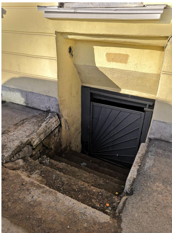
Точка 6 – Фрагмент лицевого фасада здания. Приемок пом. 2-Н
