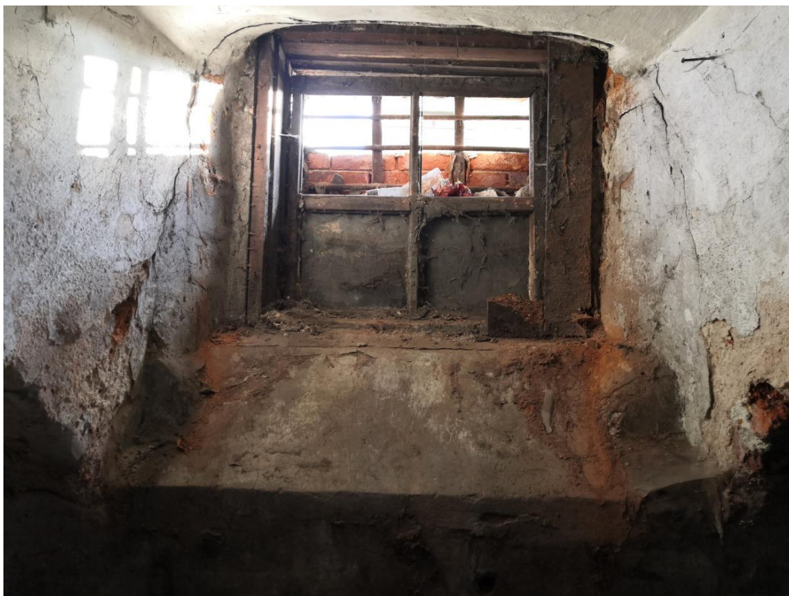
Точка 5 – пом. №2 (существующий оконный проем)
