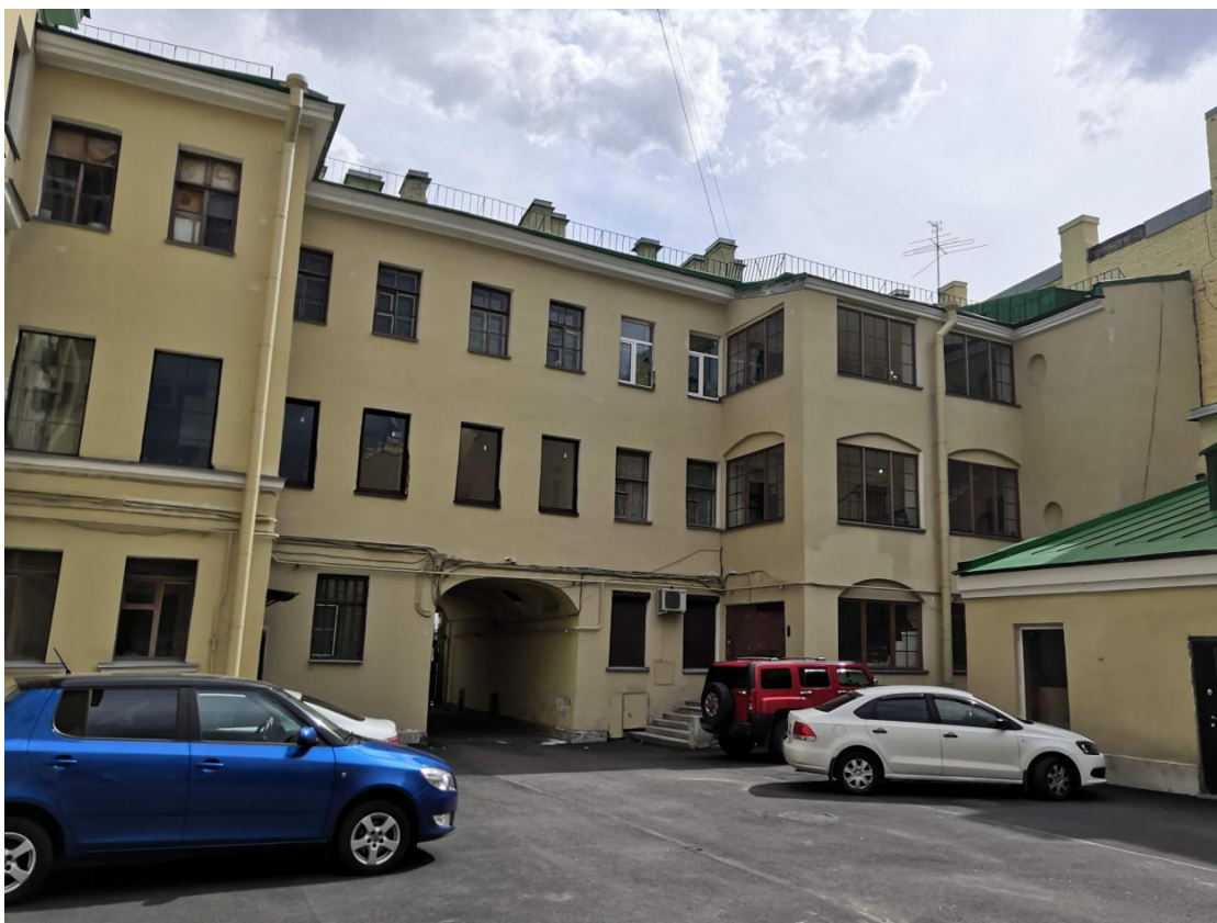
Точка 11 – Общий вид дворового фасада здания
