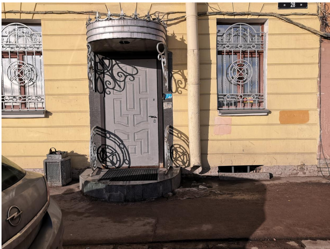
Точка 5 – Фрагмент лицевого фасада здания
