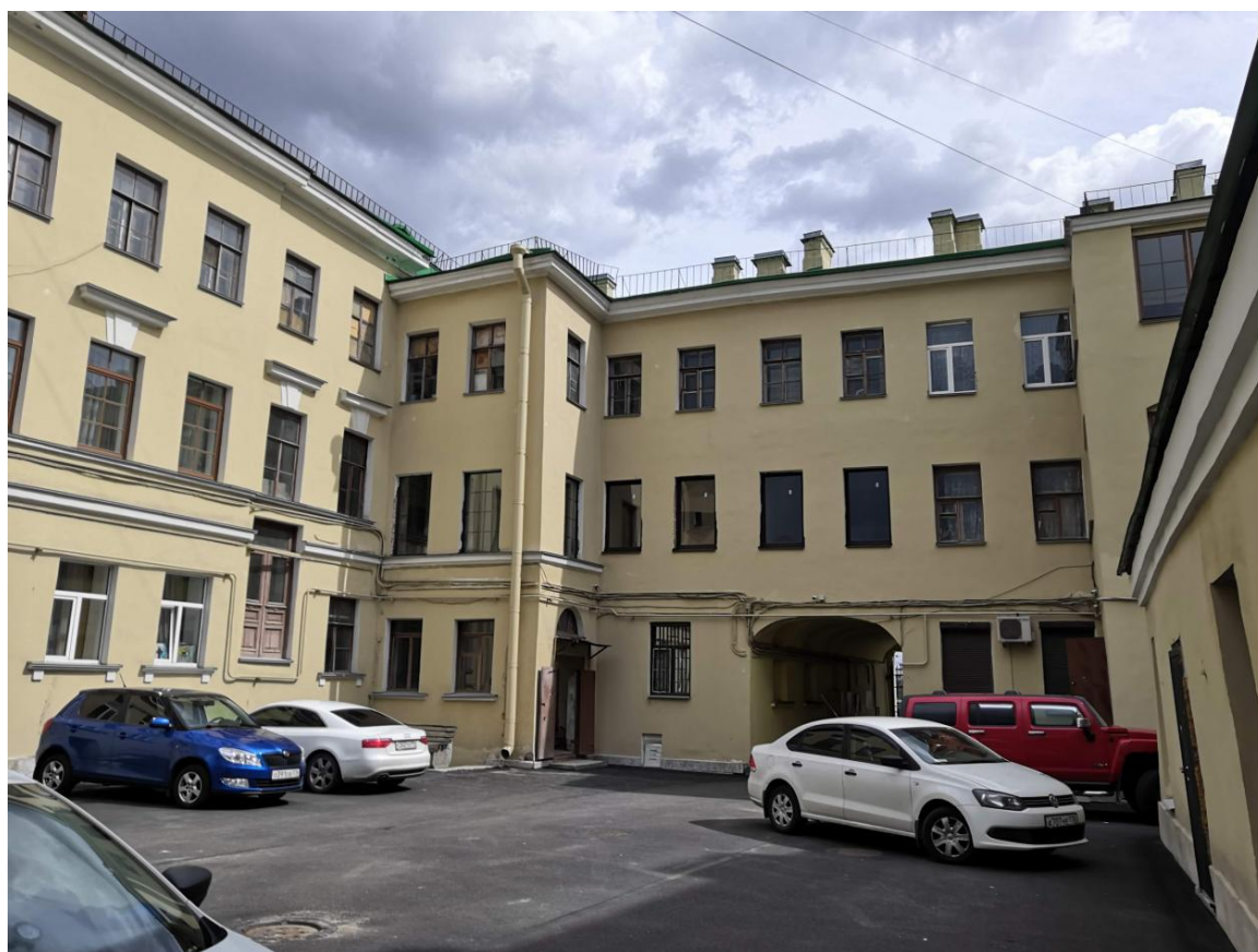
Точка 10 – Общий вид дворового фасада здания
