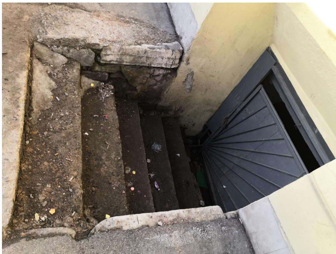
Точка 8 – Фрагмент лицевого фасада здания. Прямок пом. 2-Н
