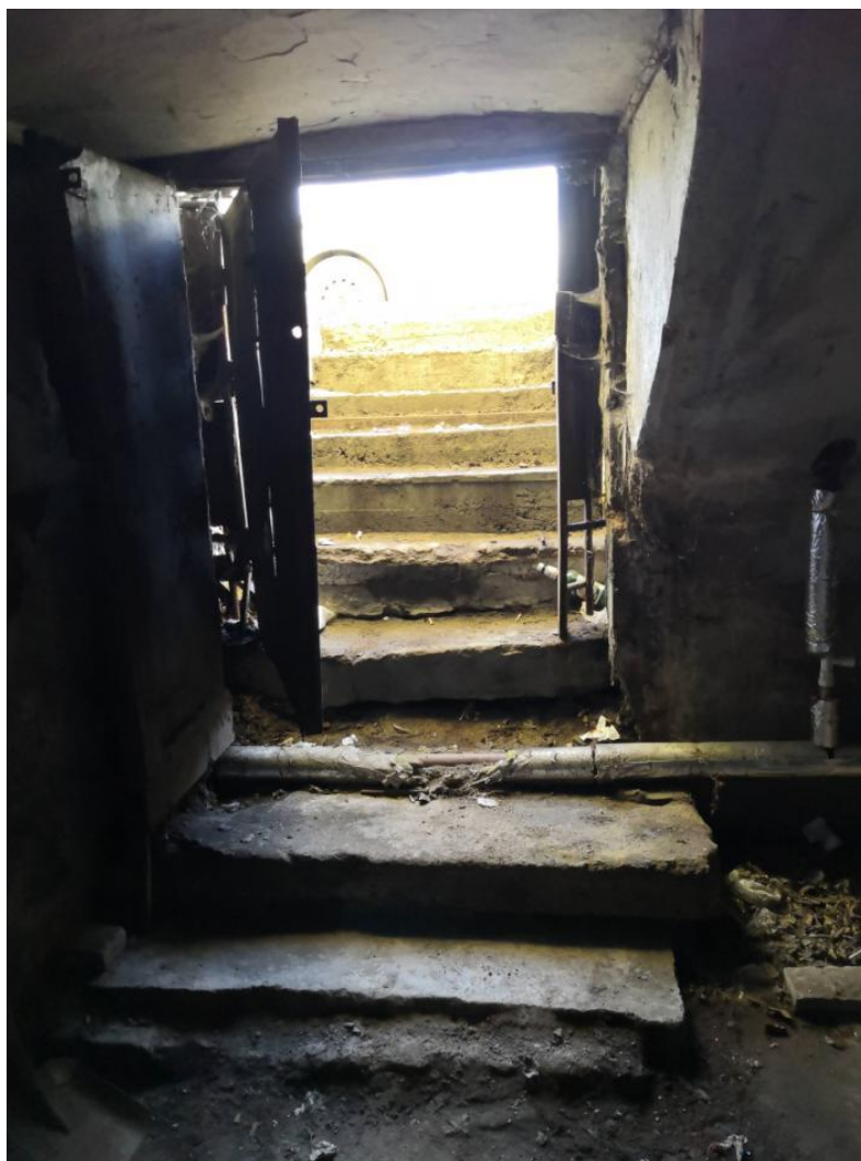
Точка 9 – пом. №2 (дверной проем)
