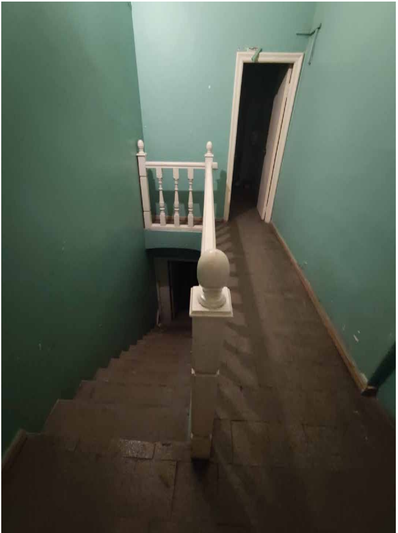
Фото 19. Объект культурного наследия регионального значения «Дом командира Уланского полка», расположенный по адресу: Санкт-Петербург, город Петергоф, Санкт-Петербургский проспект, дом 13/7. Общий вид пом. № 1-Н(18).
