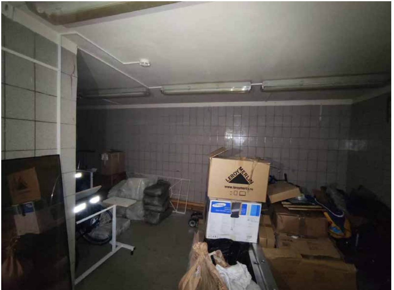
Фото 22. Объект культурного наследия регионального значения «Дом командира Уланского полка», расположенный по адресу: Санкт-Петербург, город Петергоф, Санкт-Петербургский проспект, дом 13/7. Общий вид пом. № 1-Н(16).
