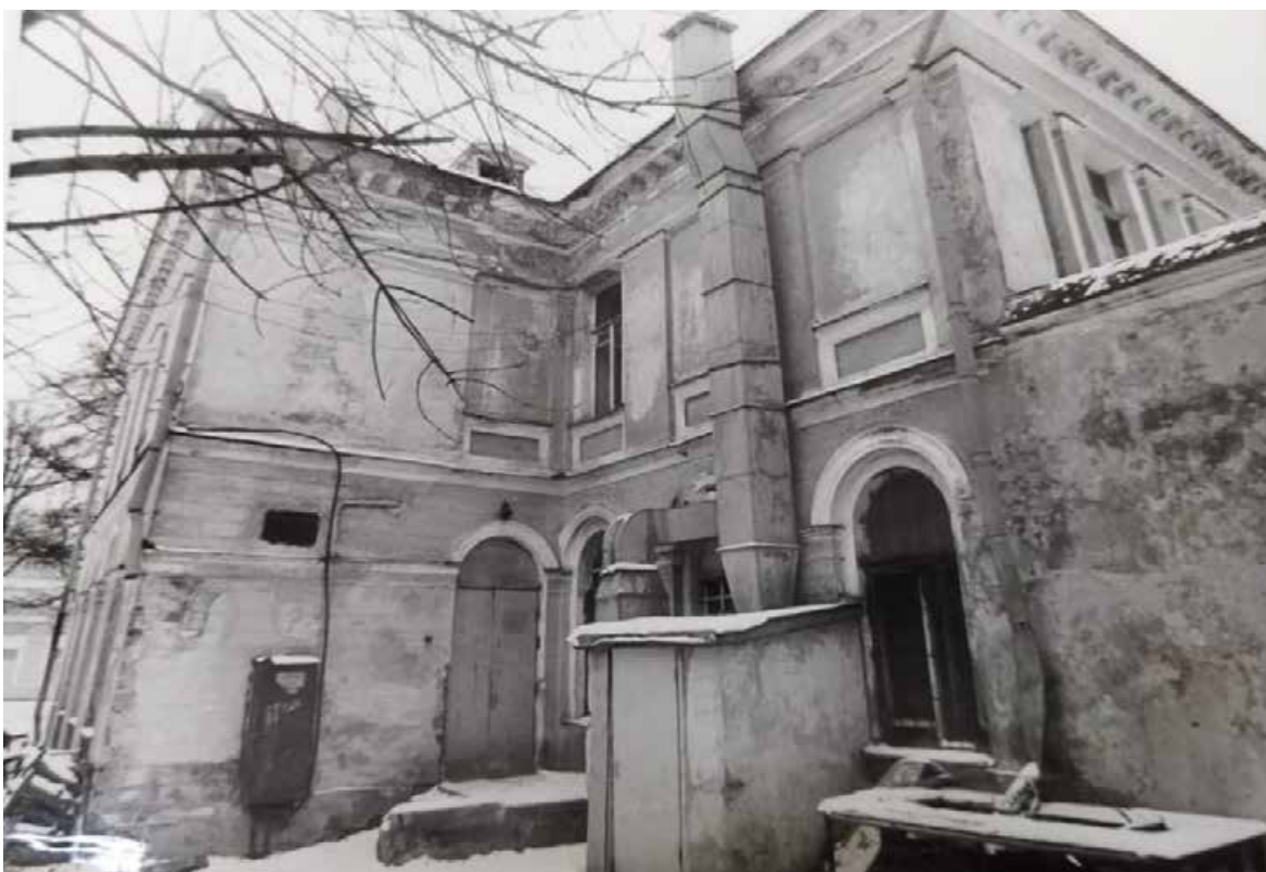
Иллюстрация 21. Дом командира Уланского полка. Северный фасад. Отдел систематизации, популяризации и хранения документированной информации об объектах культурного наследия КГИОП: - (203-Г-2) Н-4577/3 Проектная документация Банк «Петровский» г.Петродворец С.Петербургский пр. д.№ 13/7
