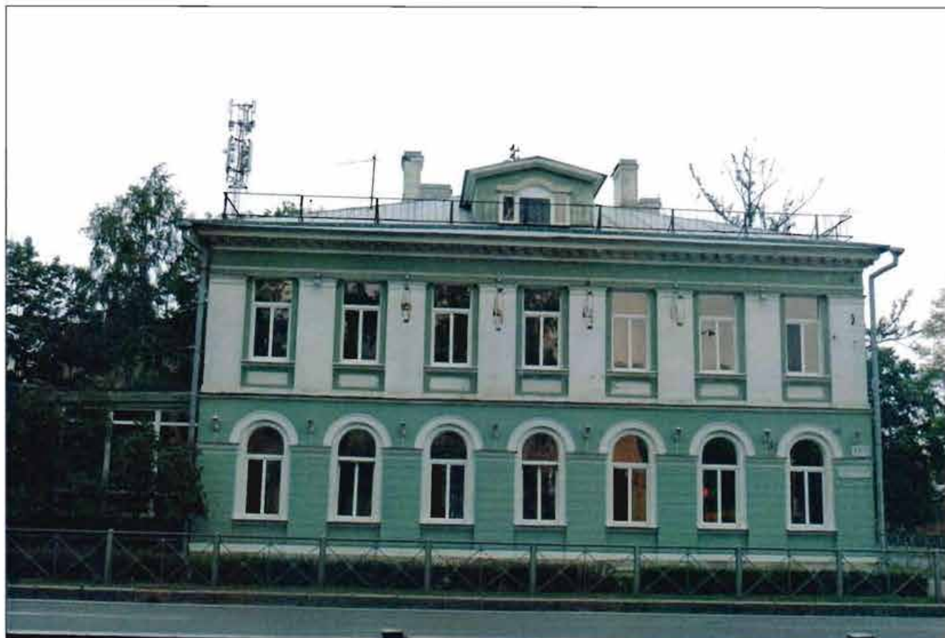
2. Южный фасад. Общий вид.
