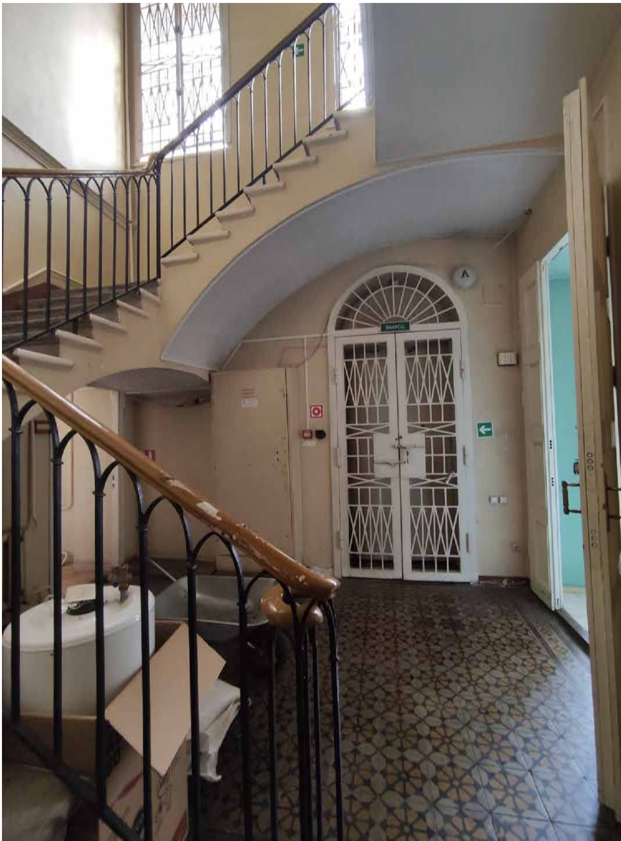
Фото 14. Объект культурного наследия регионального значения «Дом командира Уланского полка», расположенный по адресу: Санкт-Петербург, город Петергоф, Санкт-Петербургский проспект, дом 13/7. Общий вид пом. № 1-Н(24).
