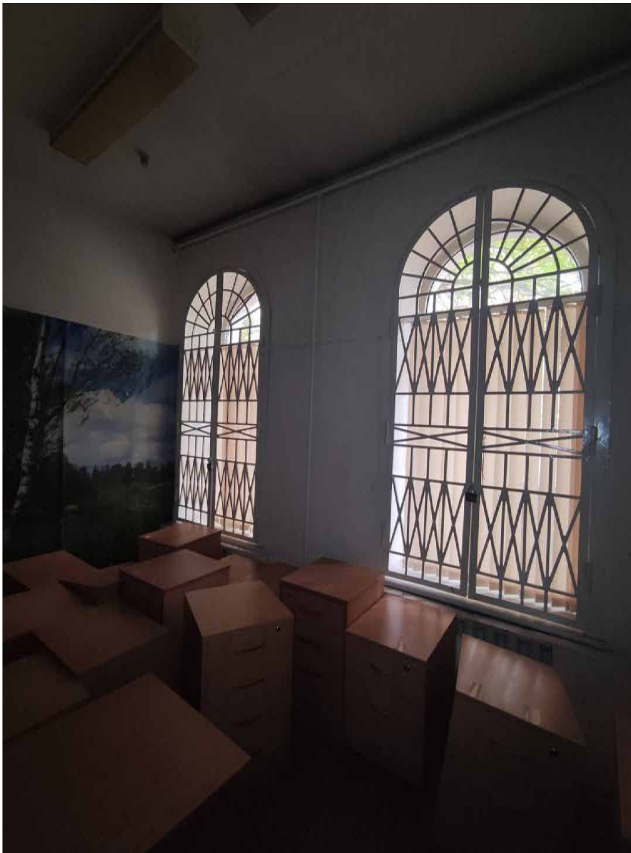
Фото 26. Объект культурного наследия регионального значения «Дом командира Уланского полка», расположенный по адресу: Санкт-Петербург, город Петергоф, Санкт-Петербургский проспект, дом 13/7. Общий вид пом. № 1-Н(10).
