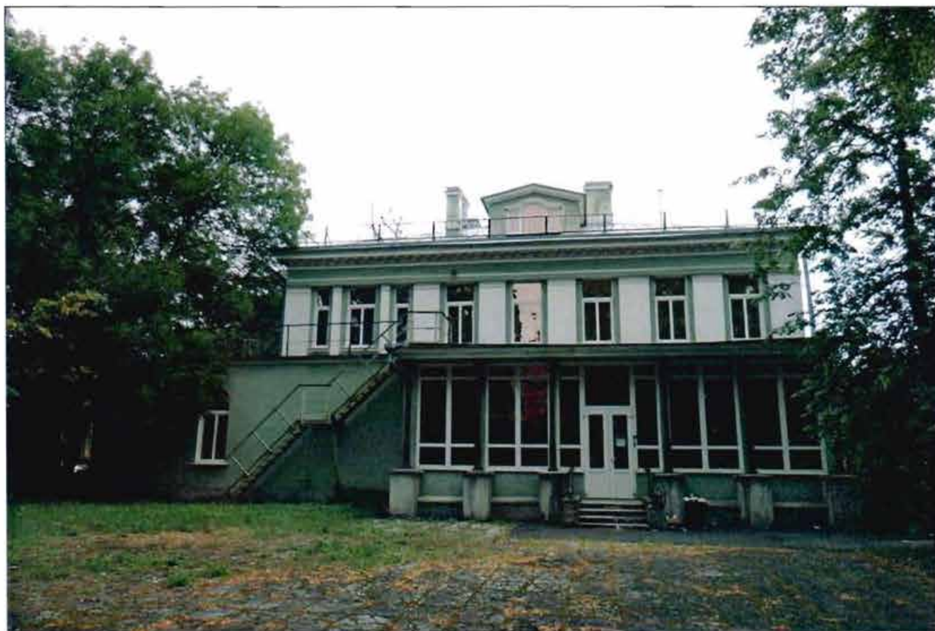
4. Западный фасад. Общий вид.
