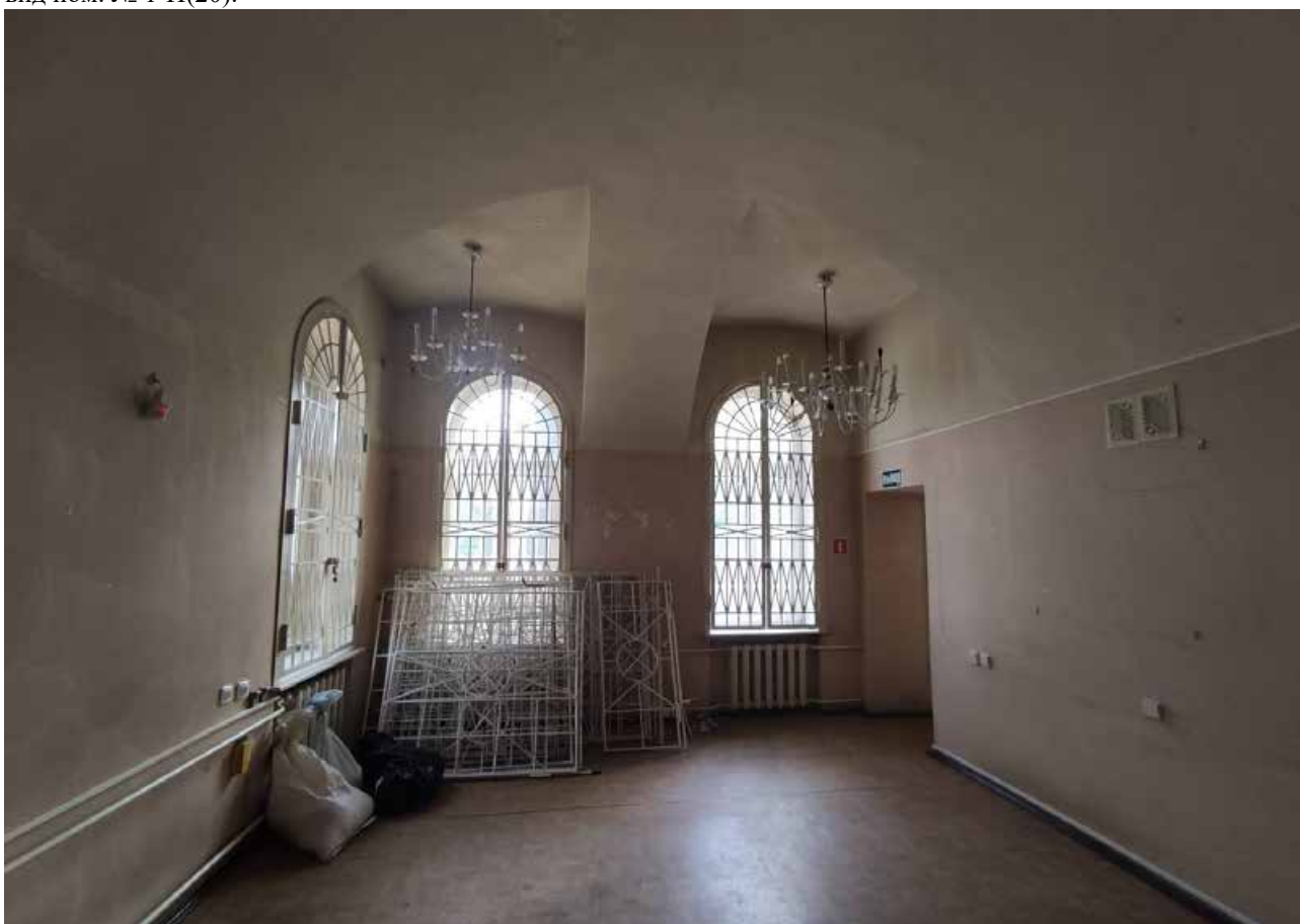
Фото 17. Объект культурного наследия регионального значения «Дом командира Уланского полка», расположенный по адресу: Санкт-Петербург, город Петергоф, Санкт-Петербургский проспект, дом 13/7. Общий вид пом. № 1-Н(20).
