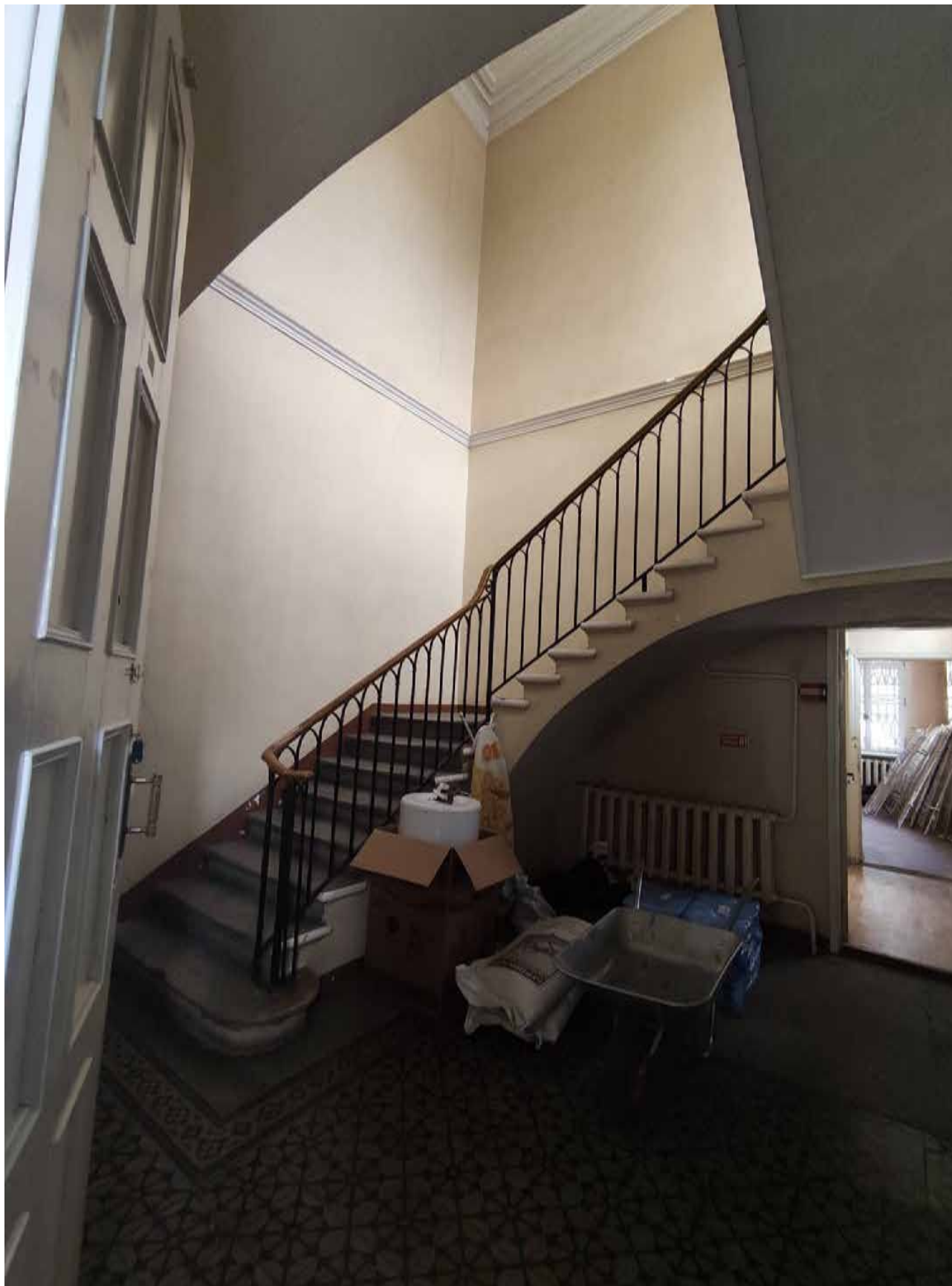
Фото 13. Объект культурного наследия регионального значения «Дом командира Уланского полка», расположенный по адресу: Санкт-Петербург, город Петергоф, Санкт-Петербургский проспект, дом 13/7. Общий вид пом. № 1-Н(24).
