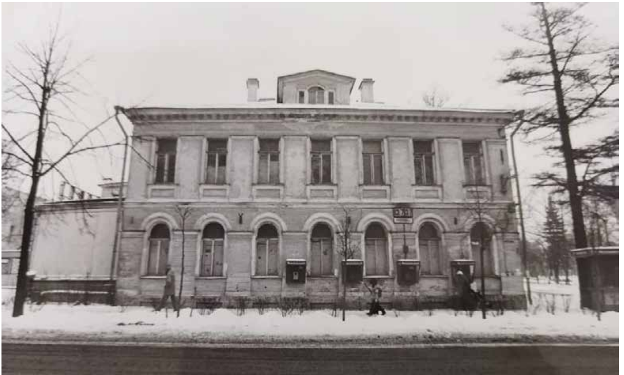
Иллюстрация 18. Дом командира Уланского полка. Южный фасад. Отдел систематизации, популяризации и хранения документированной информации об объектах культурного наследия КГИОП: - (203-Г-2) Н-4577/3 Проектная документация Банк «Петровский» г.Петродворец С.Петербургский пр. д.№ 13/7
