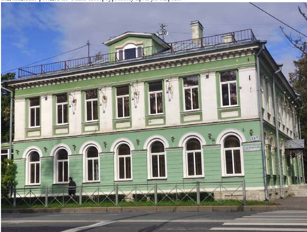
Фото 2. Объект культурного наследия регионального значения «Дом командира Уланского полка», расположенный по адресу: Санкт-Петербург, город Петергоф, Санкт-Петербургский проспект, дом 13/7. Общий вид лицевого фасада по Санкт-Петербургскому пр.
