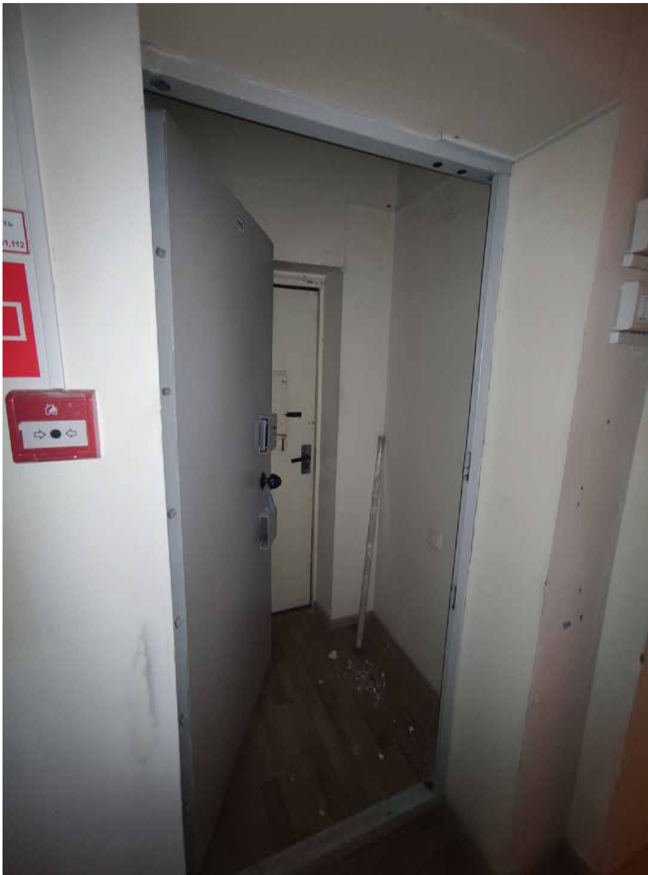
Фото 25. Объект культурного наследия регионального значения «Дом командира Уланского полка», расположенный по адресу: Санкт-Петербург, город Петергоф, Санкт-Петербургский проспект, дом 13/7. Общий вид пом. №№ 1-Н(11,12).
