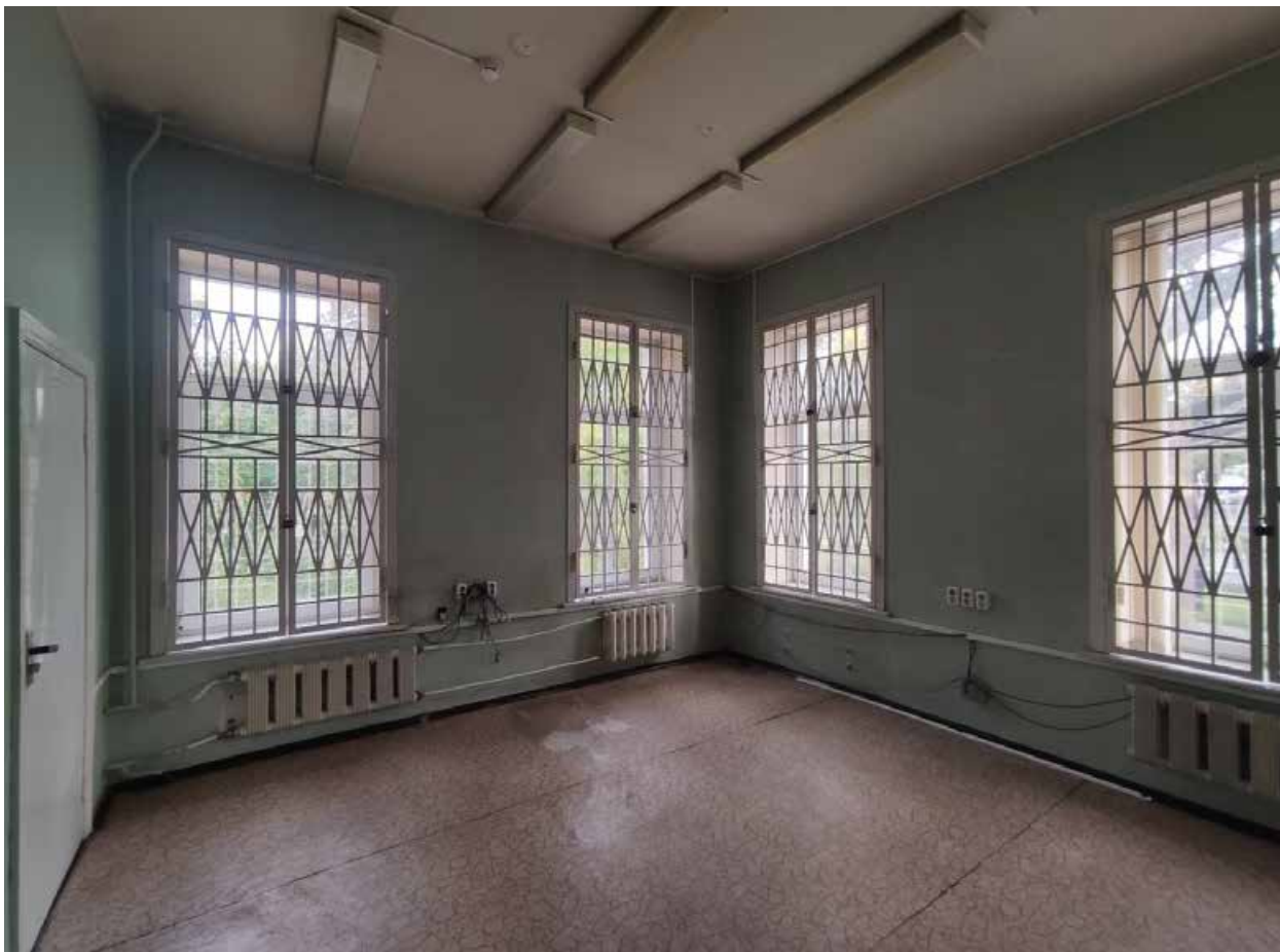
Фото 43. Объект культурного наследия регионального значения «Дом командира Уланского полка», расположенный по адресу: Санкт-Петербург, город Петергоф, Санкт-Петербургский проспект, дом 13/7. Общий вид пом. № 2-Н(5).
