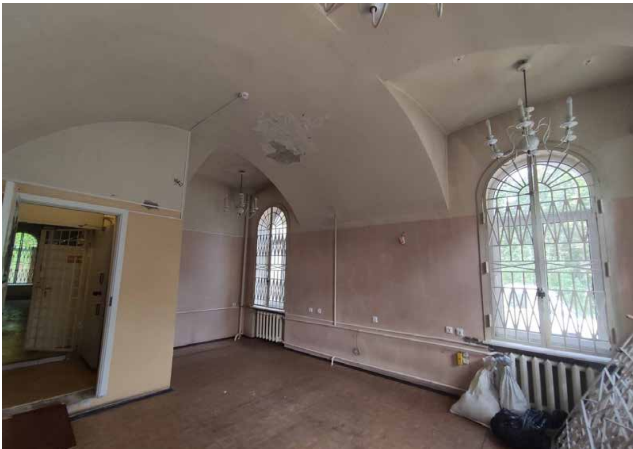
Фото 16. Объект культурного наследия регионального значения «Дом командира Уланского полка», расположенный по адресу: Санкт-Петербург, город Петергоф, Санкт-Петербургский проспект, дом 13/7. Общий вид пом. № 1-Н(20).
