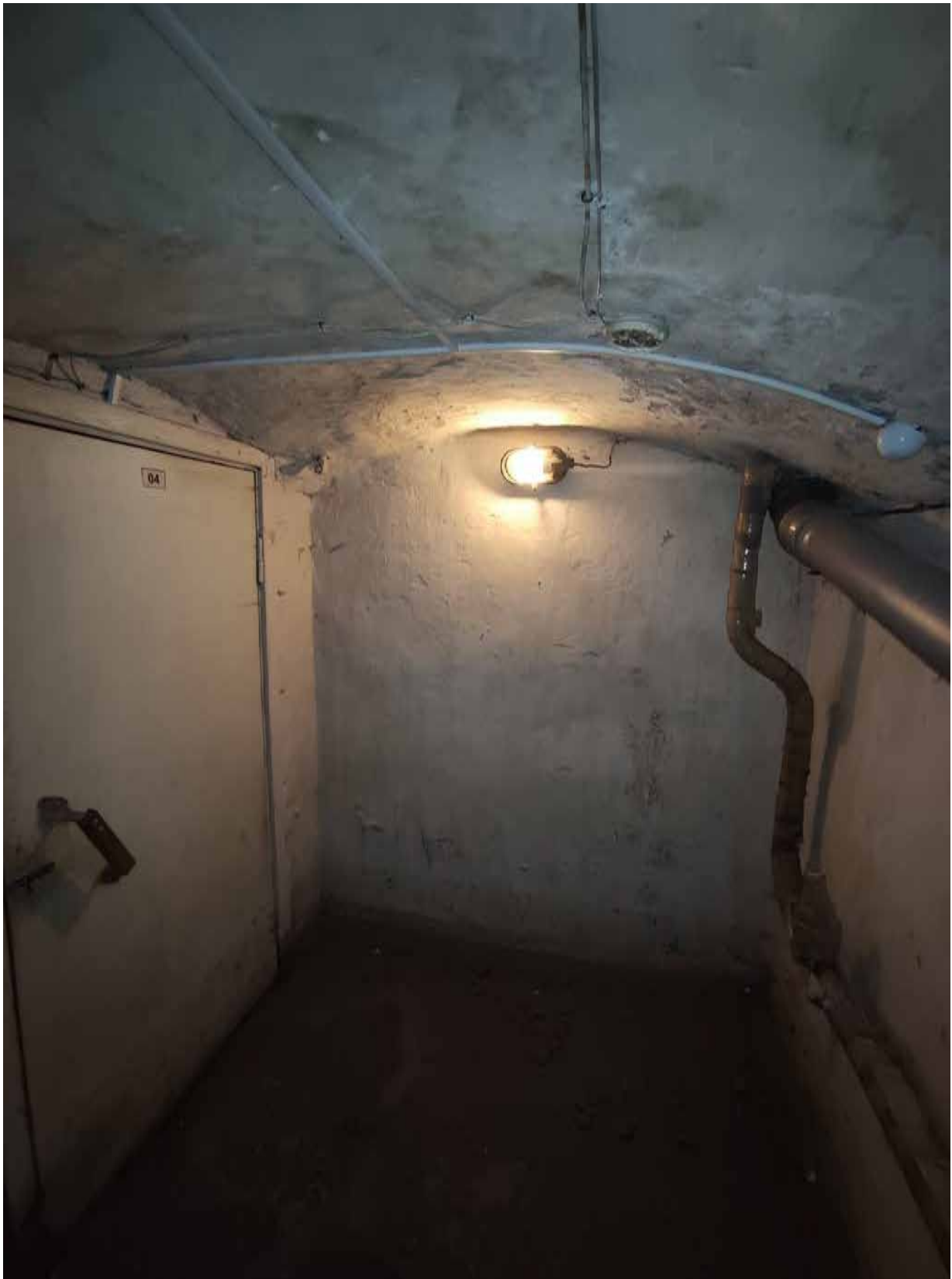
Фото 52 Объект культурного наследия регионального значения «Дом командира Уланского полка», расположенный по адресу: Санкт-Петербург, город Петергоф, Санкт-Петербургский проспект, дом 13/7. Общий вид пом. № 4-Н(1).
