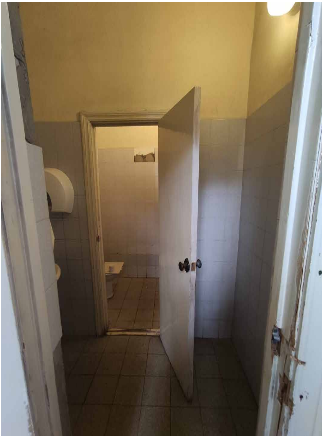
Фото 15. Объект культурного наследия регионального значения «Дом командира Уланского полка», расположенный по адресу: Санкт-Петербург, город Петергоф, Санкт-Петербургский проспект, дом 13/7. Общий вид пом. №№ 1-Н(21,22).
