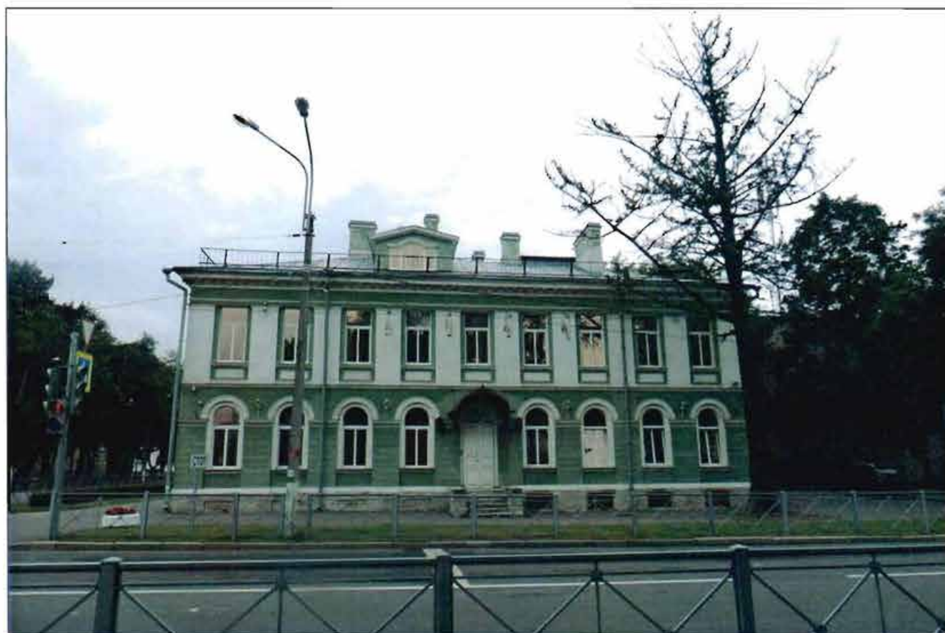
3. Восточный фасад. Общий вид.
