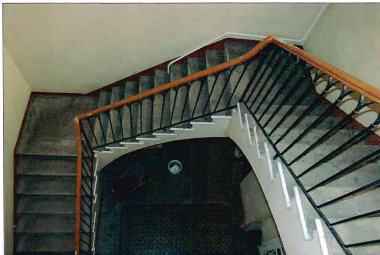
8. Интерьер. Фрагмент. Главная лестница.
