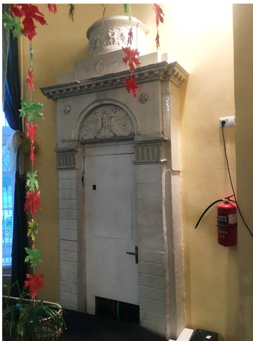
Фото №14. Помещение №1-Н (20), печь 4 (маркировка согласно проекту), общий вид.
