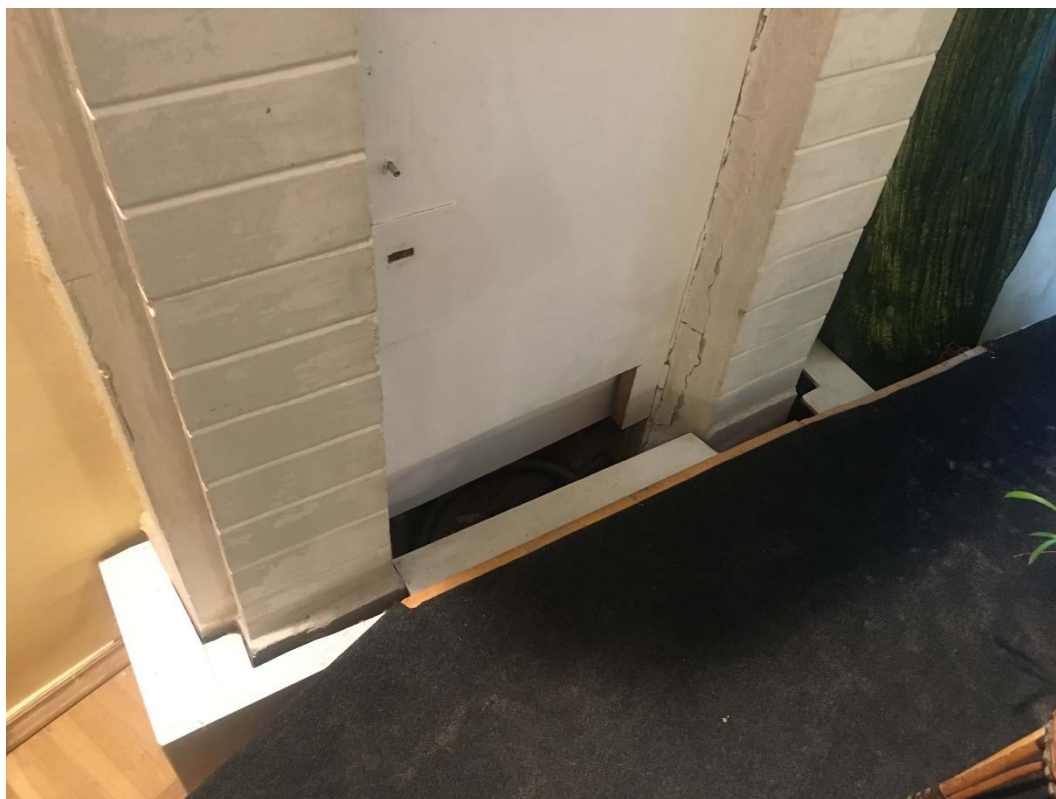
Фото №25. Помещение №1-Н (20), печь 3 (маркировка согласно проекту). Основание печи.
