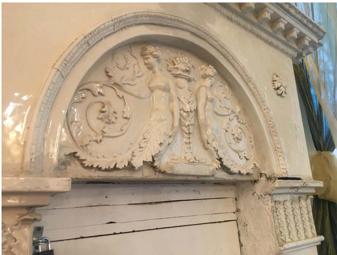
Фото №26. Помещение №1-Н (20), печь 3 (маркировка согласно проекту). Состояние декора.
