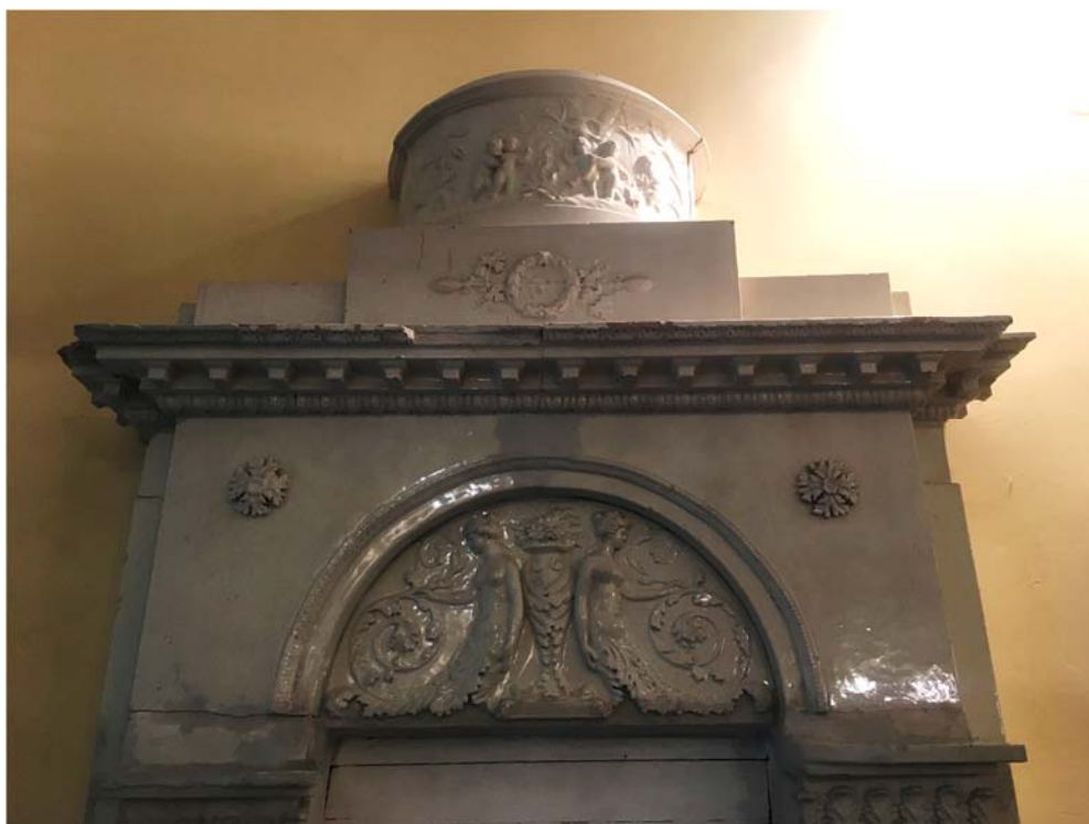
Фото №17. Помещение №1-Н (20), печь 4 (маркировка согласно проекту). Верхняя часть печи с отделкой в виде композиций с изображением античных сюжетов.
