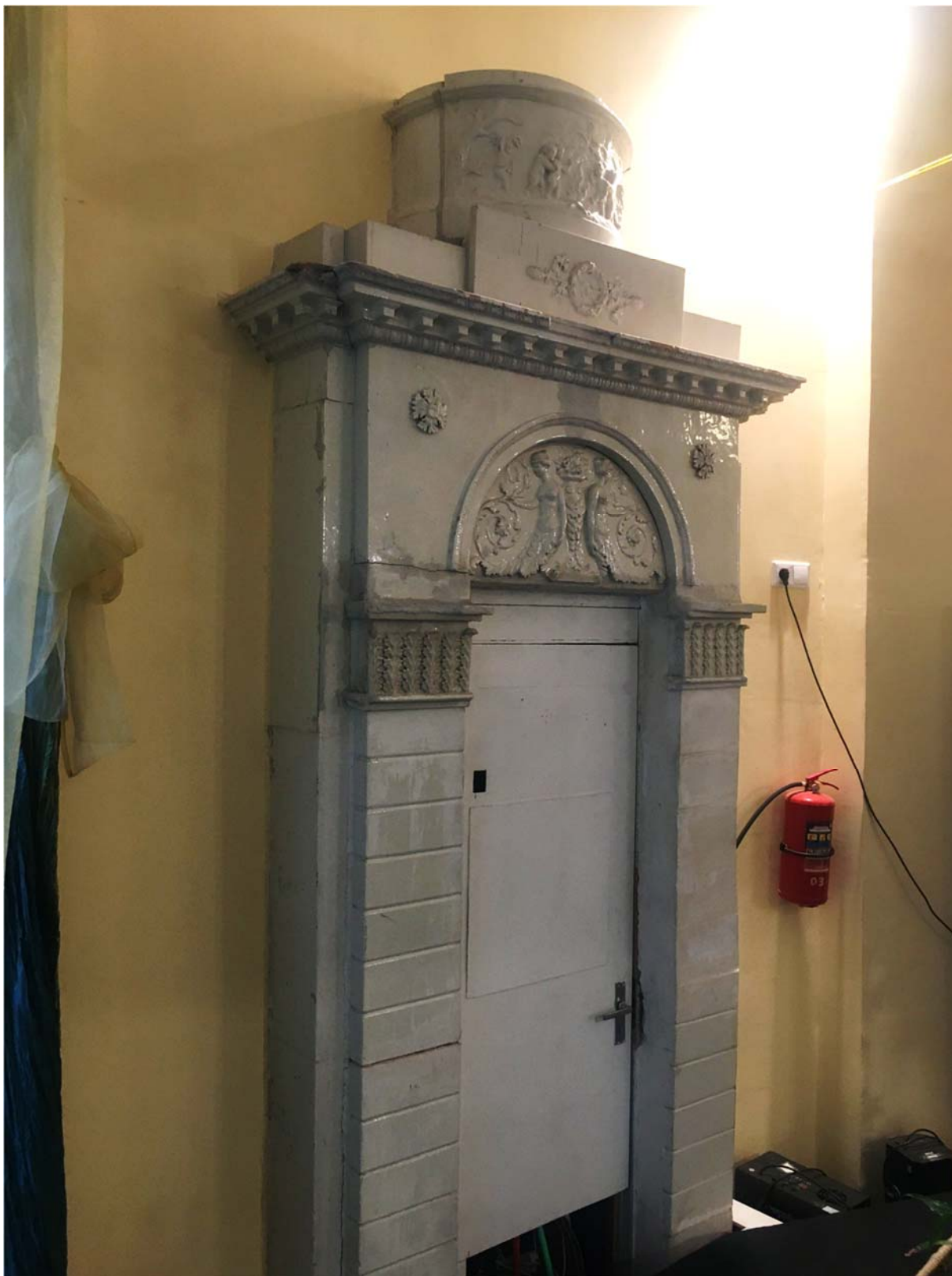
Фото №15. Помещение №1-Н (20), печь 4 (маркировка согласно проекту), общий вид.
