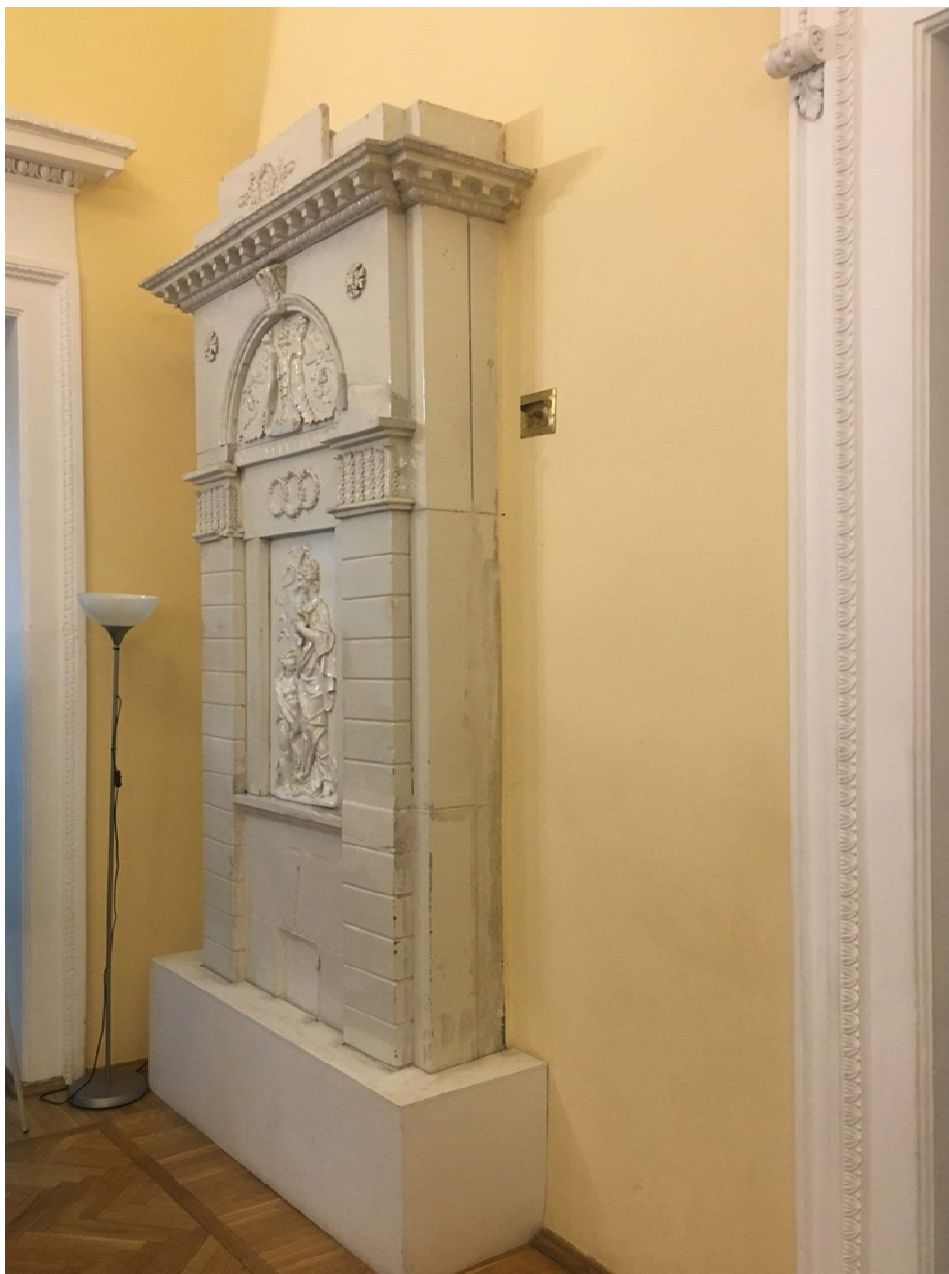
Фото №5. Помещение №1-Н (20), печь 1 (маркировка согласно проекту), общий вид.
