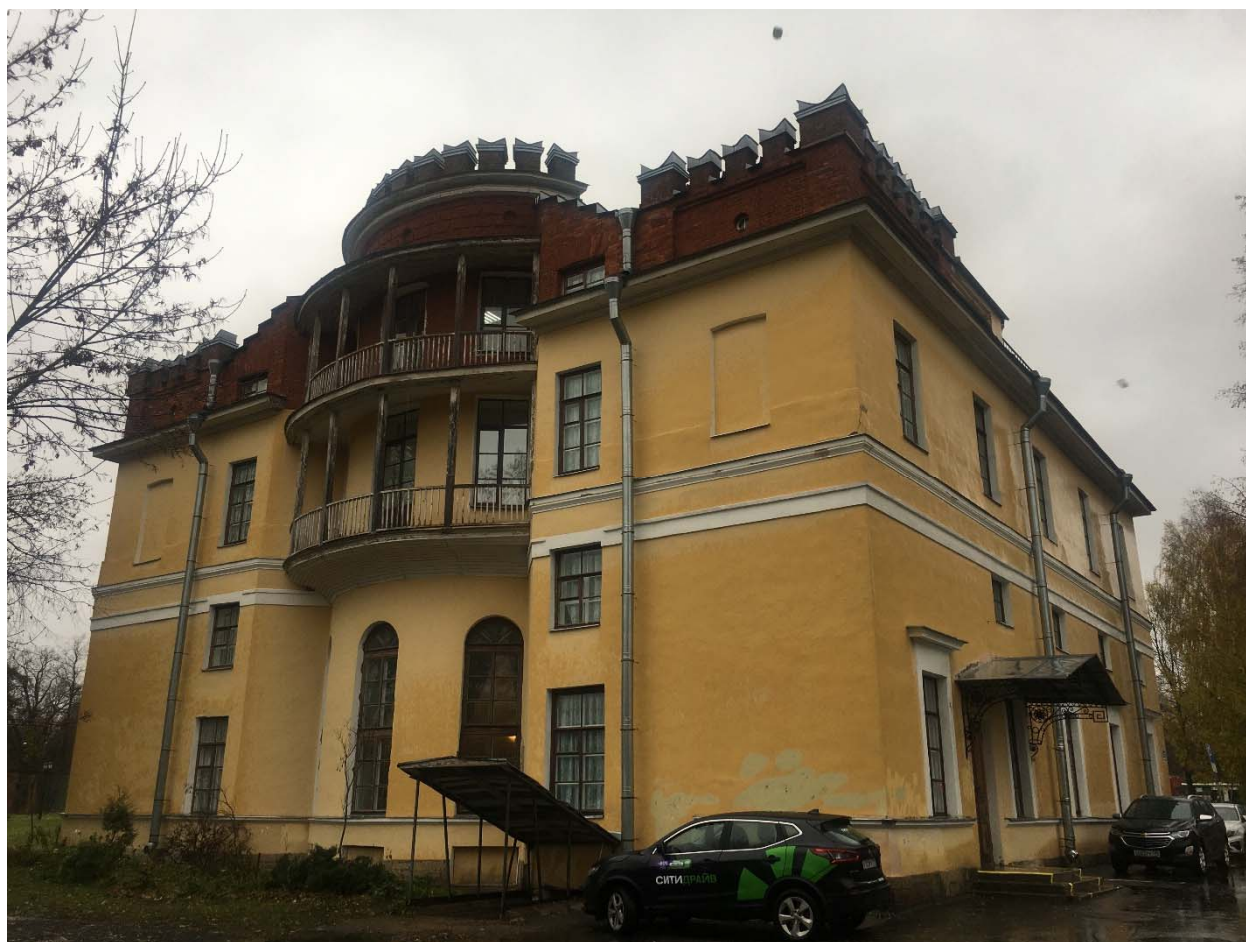
Фото №2. Общий вид объекта культурного наследия. Юго-западный фасад.
