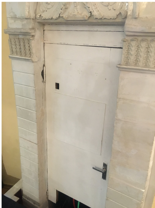
Фото №16. Помещение №1-Н (20), печь 4 (маркировка согласно проекту). Центральная часть печи утрачена.
