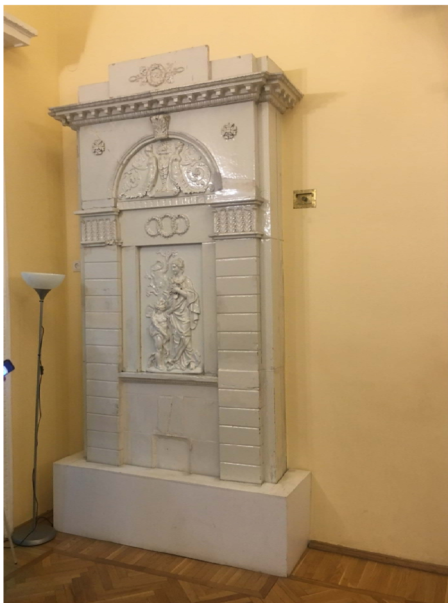
Фото №4. Помещение №1-Н (20), печь 1 (маркировка согласно проекту), общий вид.
