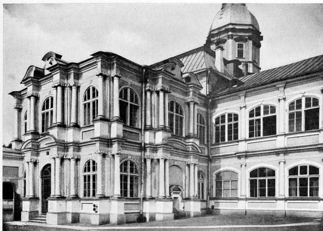
31. Лестничная пристройка Александро-Благовещенской церкви . 1900е
