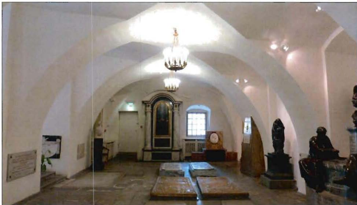
4. Сводчатые перекрытия в уровне первого этажа.
