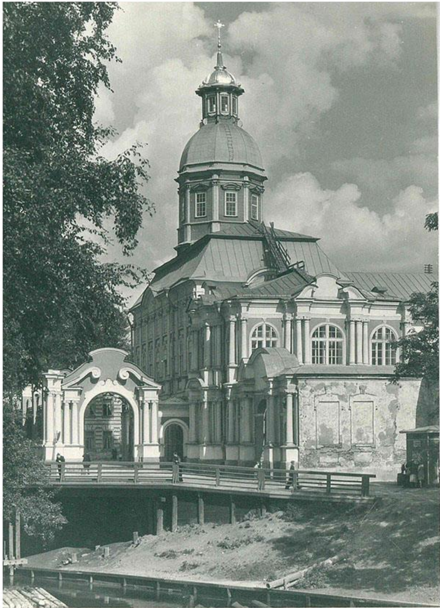
47. . А.К. Григорьев. Вид на здание Благовещенской церкви с воротами после ремонта фасадов. Фотография. 1950 г. Архив КГИОП (№ инв. 14917)
