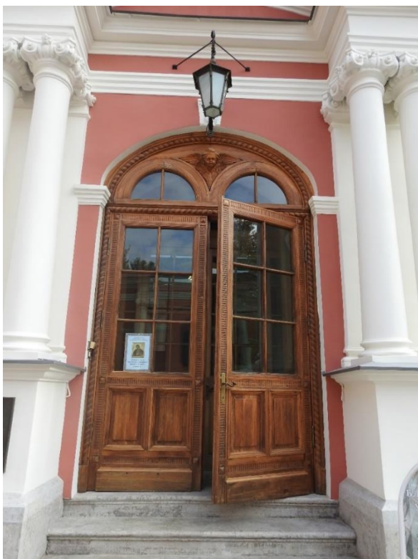
25. «Церковь Благовещения Пресвятой Богородицы с усыпальницей. Здесь похоронен Суворов А.В. (1729-1800), полководец», входящего в состав объекта культурного наследия федерального значения «Александрово-Невская Лавра», расположенного по адресу: Санкт-Петербург, наб. р. Монастырки, д.1, лит. Д. Дверной проём Благовещенской усыпальницы коробовый (трехцентровой) с фигурным замковым камнем. Фото 14.09.2021г.
