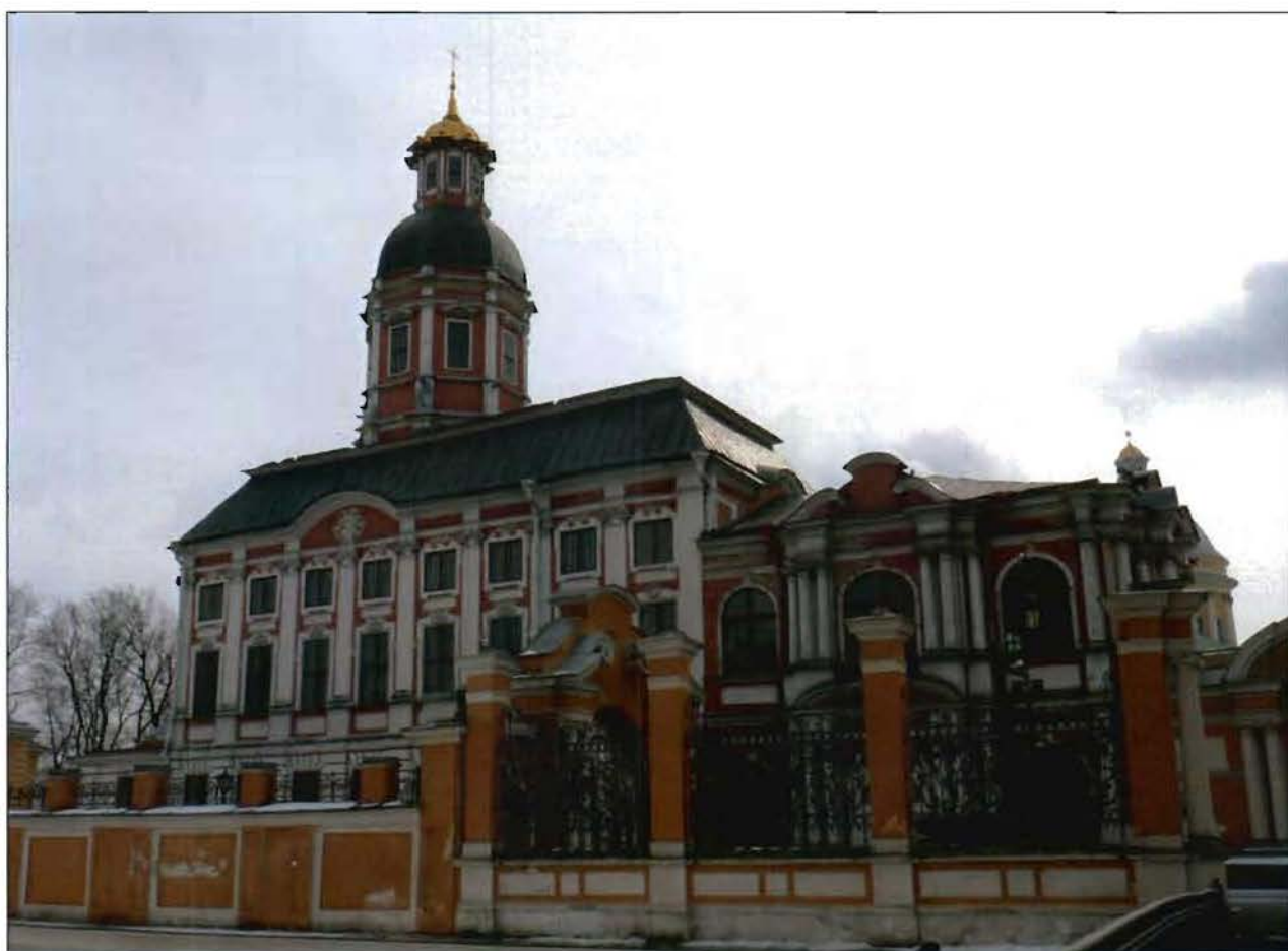
1. Общий вид с северо-запада.
