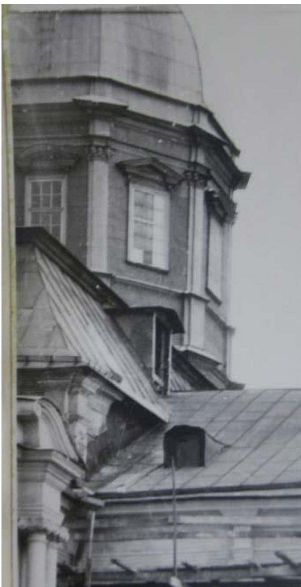
46. Неизвестный автор. Фрагмент фото. Б. Духовская церковь в процессе фасадно-реставрационных работ 1950 года. Фотография. 1950 г. Архив КГИОП. П-155. ((Фотоальбом А 847. Фото № 32578а).
