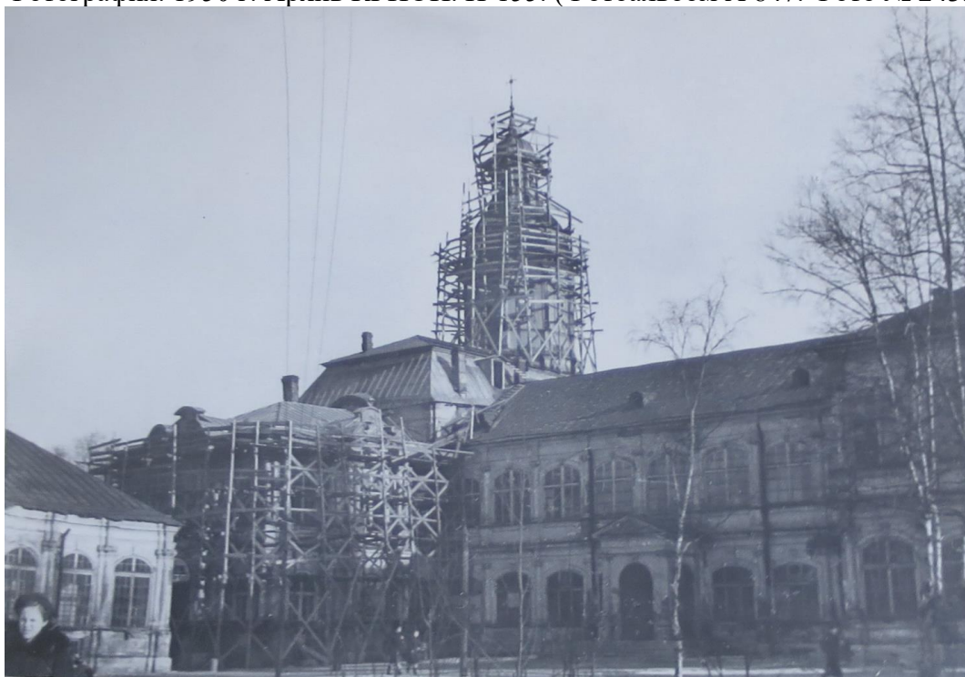
42. Неизвестный автор. Здание усыпальницы Суворова. В процессе фасадно-реставрационных работ. Фотография. 1950 г. Архив КГИОП. П-155. (Фотоальбом А 847. Фото № 31775).
