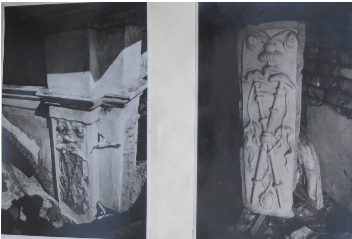
44. Неизвестный автор. Здание усыпальницы Суворова. Барельеф фасада до и после реставрации. Фотография. 1950 г. Архив КГИОП. П-155. (Фотоальбом А 847. Фото № б/н).
