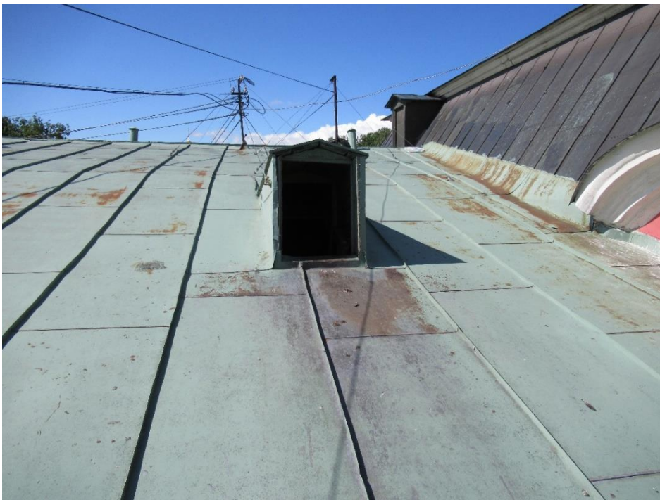
10. «Церковь Благовещения Пресвятой Богородицы с усыпальницей. Здесь похоронен Суворов А.В. (1729-1800), полководец», входящего в состав объекта культурного наследия федерального значения «Александро-Невская Лавра», расположенного по адресу: Санкт-Петербург, наб. р. Монастырки, д.1, лит. Д. Общий вид на медную кровлю основного объема. Фото 14.09.2021г.
