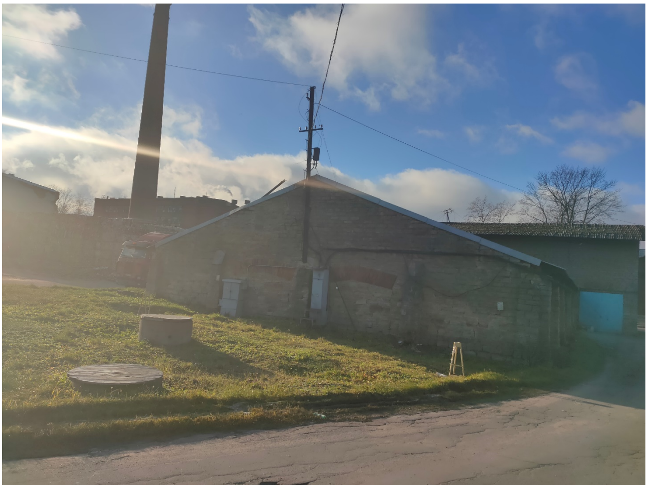
16. Восточный фасад объекта культурного наследия регионального значения «Бутовая кладовая», расположенный по адресу: г. Санкт-Петербург, Октябрьская наб., д. 54, литеры О, П. 01.11.2021
