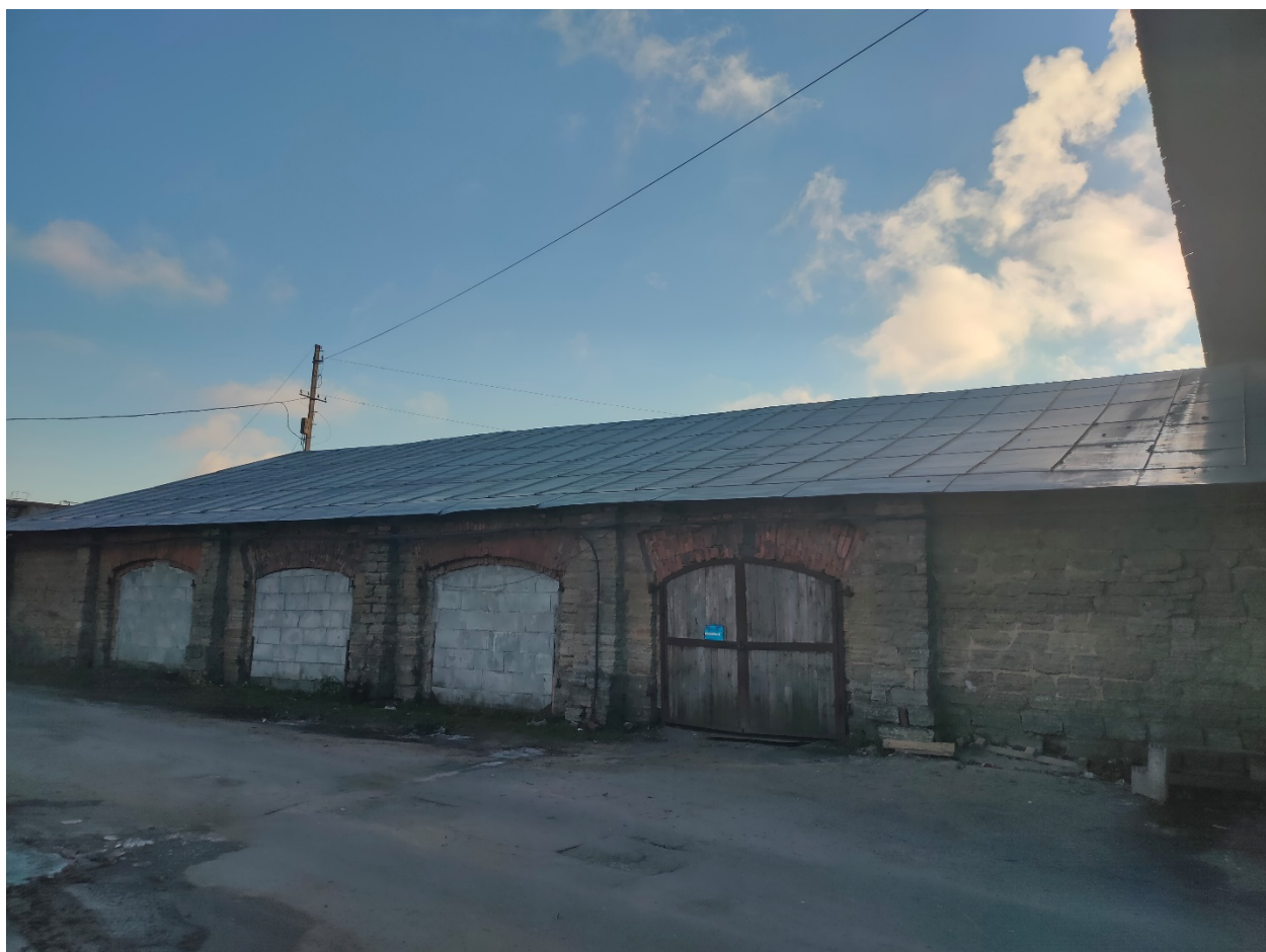
15. Северный фасад объекта культурного наследия регионального значения «Бутовая кладовая», расположенный по адресу: г. Санкт-Петербург, Октябрьская наб., д. 54, литеры О, П. 01.11.2021
