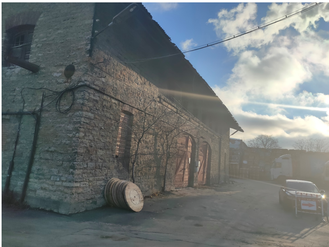
13. Западный фасад объекта культурного наследия регионального значения «Бутовская кладовая», расположенный по адресу: г. Санкт-Петербург, Октябрьская наб., д. 54, литеры О, П. 01.11.2021
