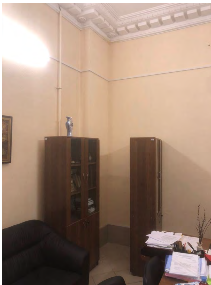
2. Здание по адресу: Санкт-Петербург, улица Профессора Попова, д. 4, Лит. В, помещение 101. Место установки камина.
