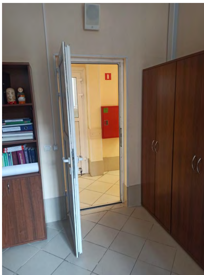
1. Здание по адресу: Санкт-Петербург, улица Профессора Попова, д. 4, Лит. В, помещение 101. Вид на входной проем в помещение №101.
