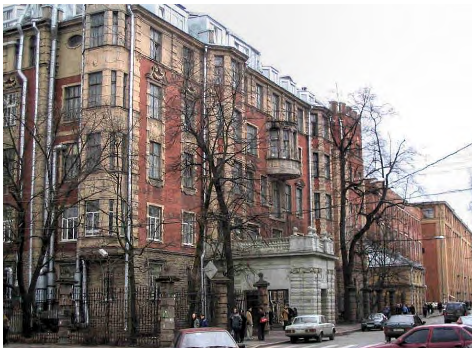
31. Здание по адресу Песочная ул. д.4 Аптекарский пр. д.6. Современное состояние. 2021г.
