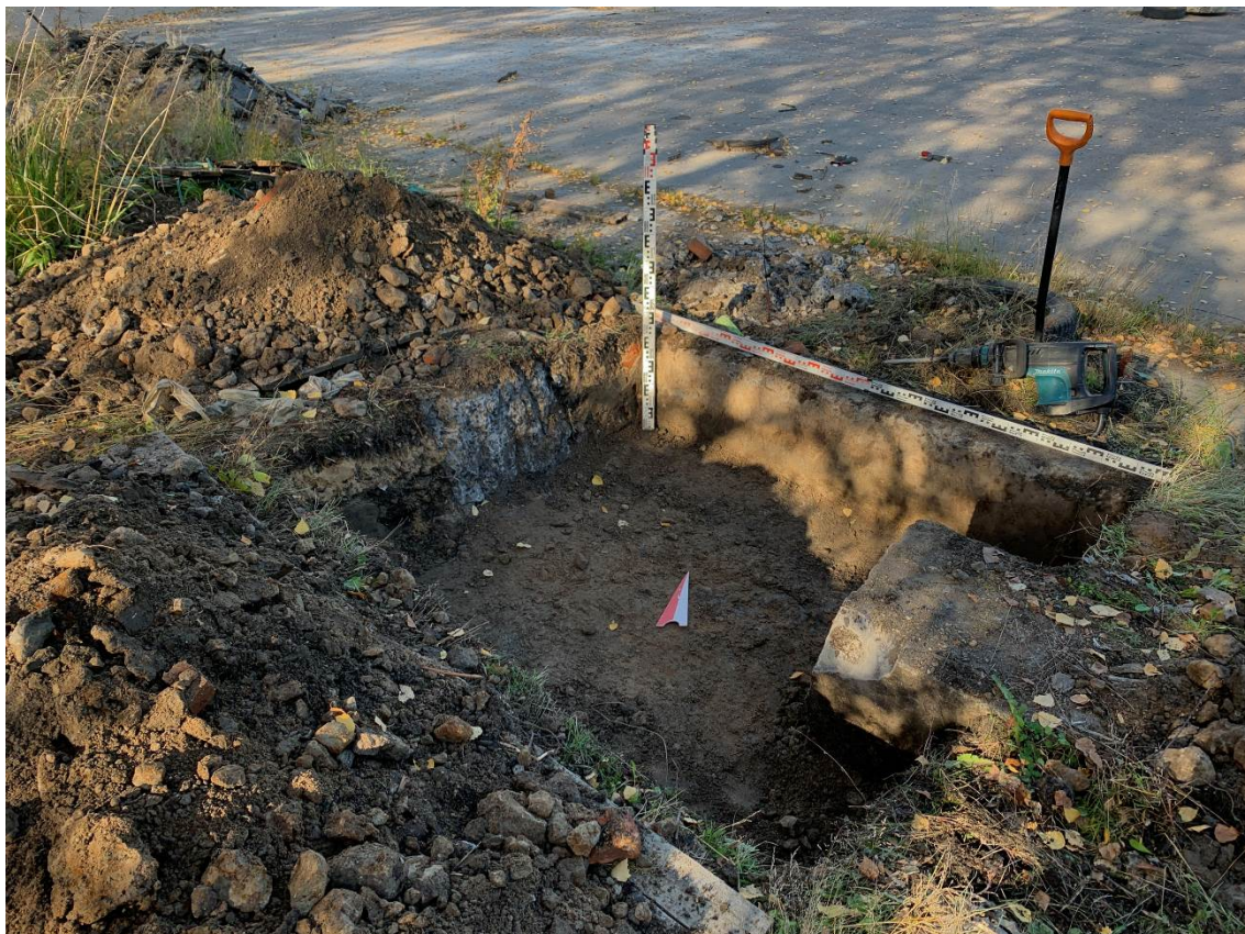
Рис. 43. Санкт-Петербург, Выборгский район, 5-й Верхний пер., д. 1, лит. В. Шурф 1. Рабочий кадр. Демонтаж бетонных плит. Вид с Ю.
