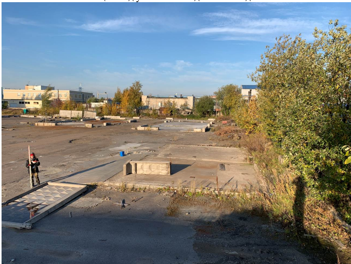
Рис. 24. Санкт-Петербург, Выборгский район, 5-й Верхний пер., д. 1, лит. В. Точка съемки 3. Общий вид участка обследования. Вид с ВСВ.
