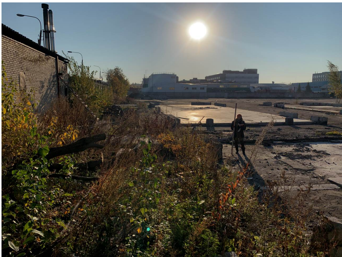
Рис. 23. Санкт-Петербург, Выборгский район, 5-й Верхний пер., д. 1, лит. В. Точка съемки 2. Общий вид участка обследования. Вид с ЗСЗ.
