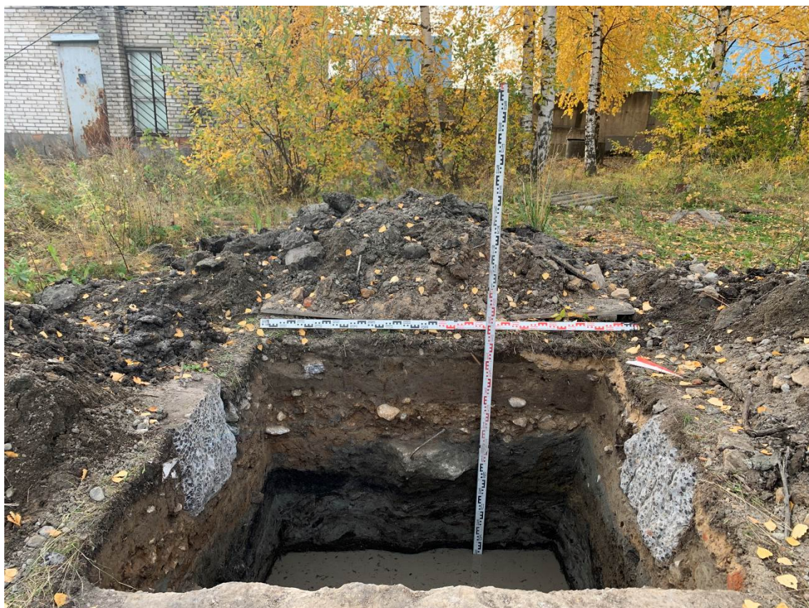
Рис. 49. Санкт-Петербург, Выборгский район, 5-й Верхний пер., д. 1, лит. В. Общий вид Шурфа 1. Финальная зачистка. Вид с СВ.
