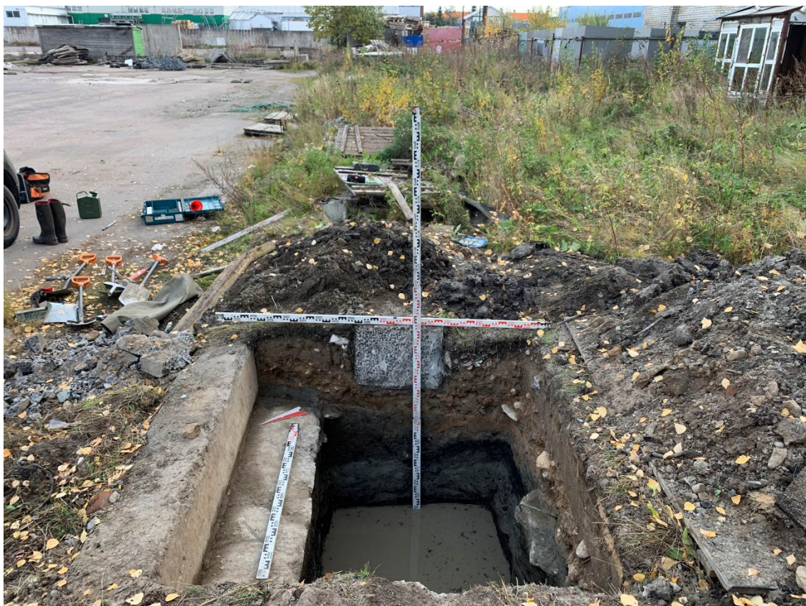
Рис. 47. Санкт-Петербург, Выборгский район, 5-й Верхний пер., д. 1, лит. В. Общий вид Шурфа 1. Финальная зачистка. Вид с СЗ.
