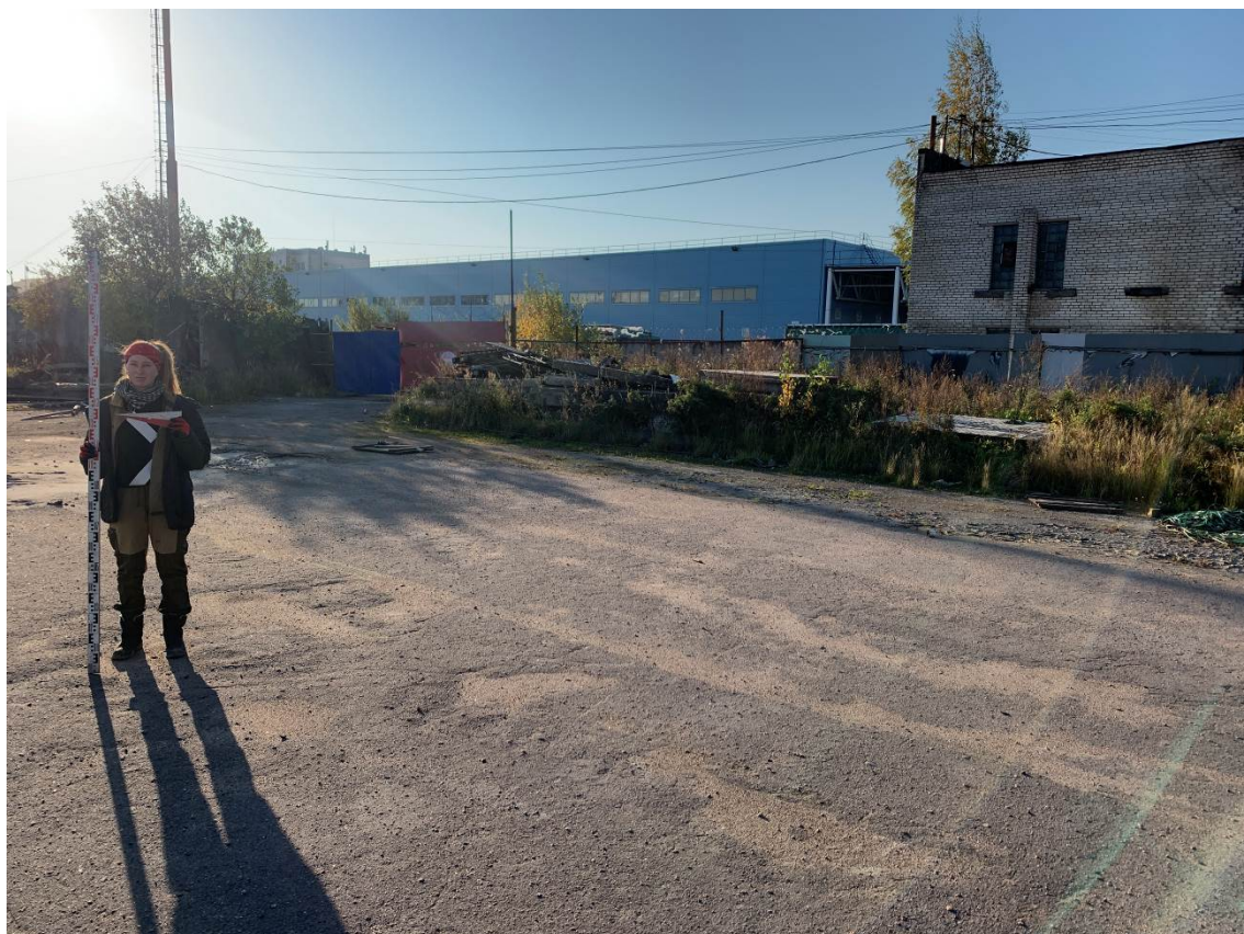
Рис. 37. Санкт-Петербург, Выборгский район, 5-й Верхний пер., д. 1, лит. В. Точка съемки 6. Общий вид участка обследования. Вид с СЗ.
