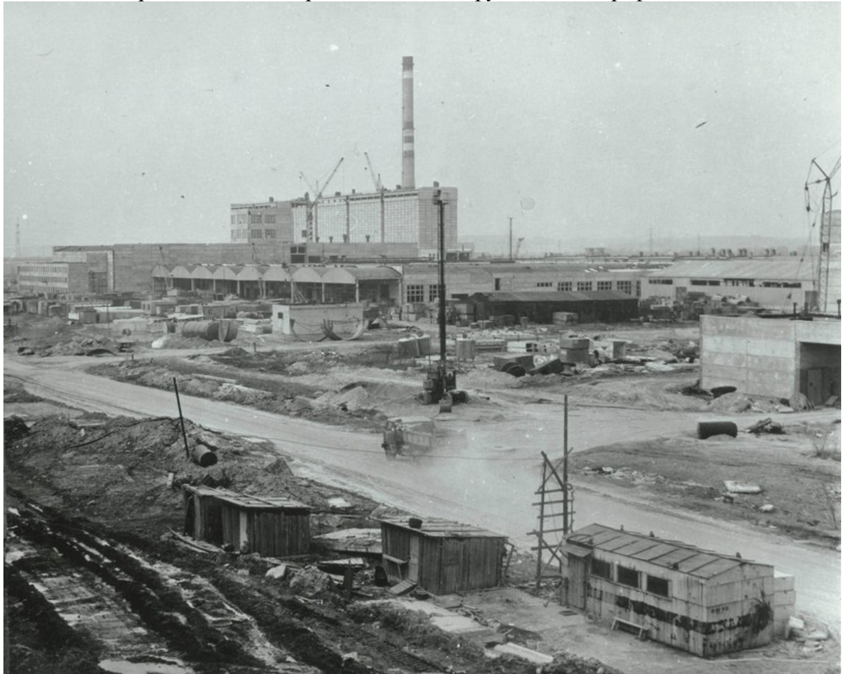
Рис. 6. Строительство пивоваренного завода «Балтика». Фотография 1987-1989 гг.
