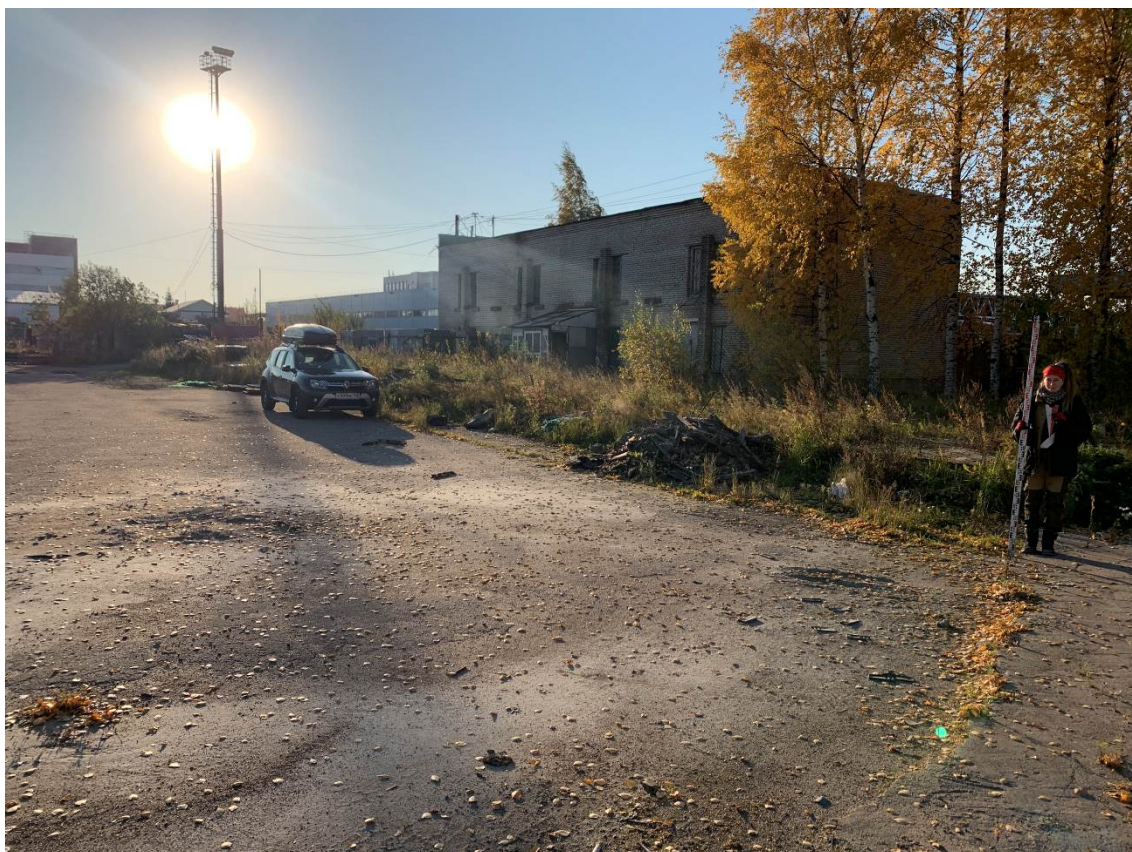
Рис. 15. Санкт-Петербург, Выборгский район, 5-й Верхний пер., д. 1, лит. В. Точка съемки 1. Общий вид участка обследования. Вид с СЗ.
