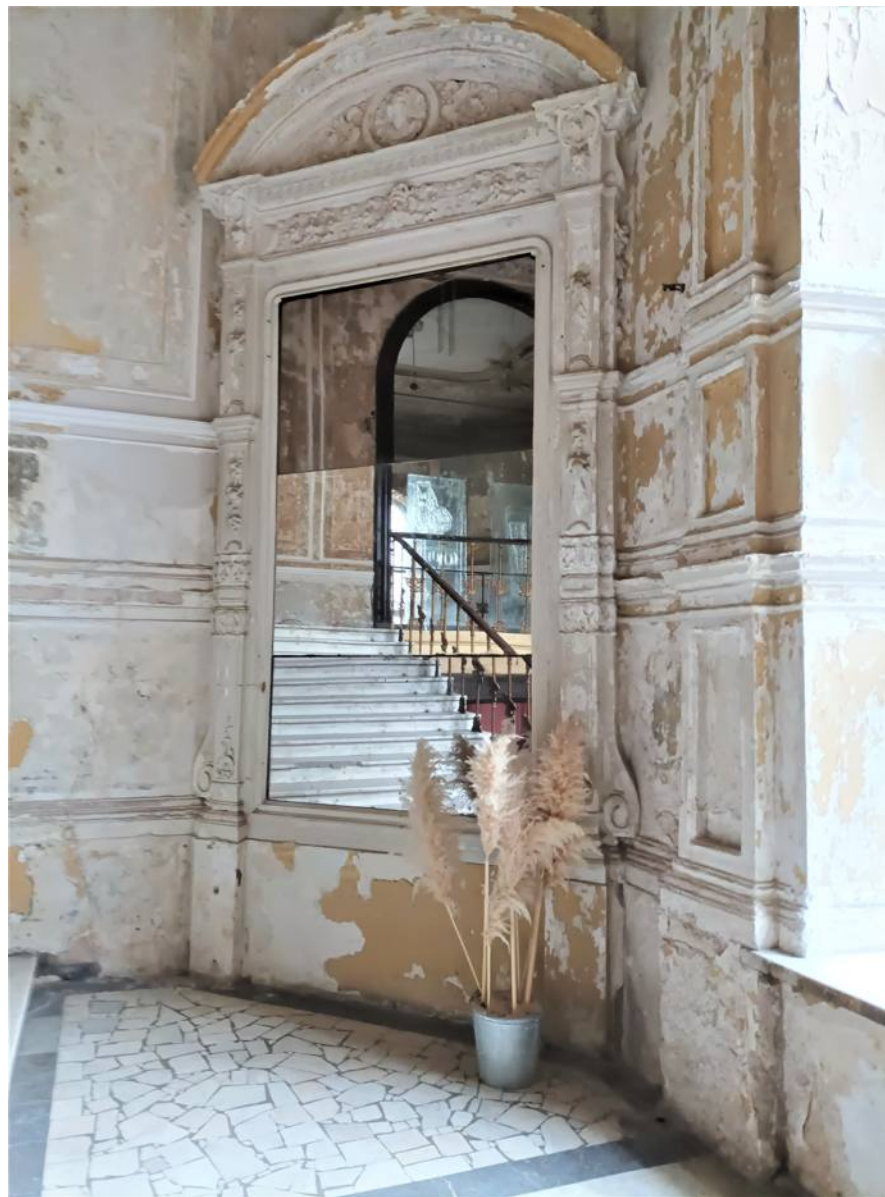
19. Объекта культурного наследия регионального значения «Дом С. С. Нарышкина», по адресу: Санкт-Петербург, Литейный проспект, дом 62, литера А (Литейный пр., 62). Парадная лестница. Фрагмент. Дата съемки: 12 октября 2021 г.
