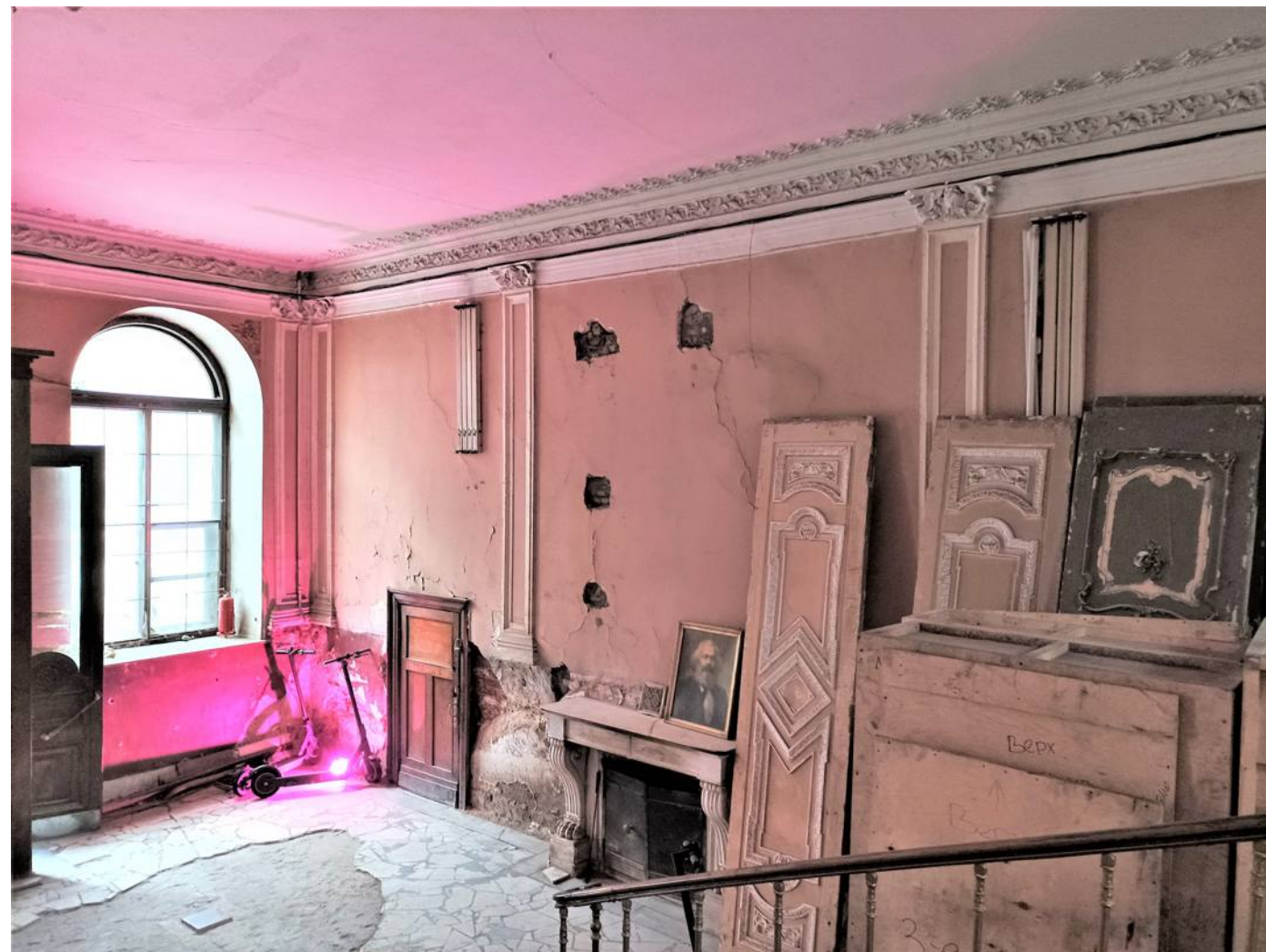
24. Объекта культурного наследия регионального значения «Дом С. С. Нарышкина», по адресу: Санкт-Петербург, Литейный проспект, дом 62, литера А (Литейный пр., 62). Вестибюль. Фрагмент стен. Дата съемки: 12 октября 2021 г.
