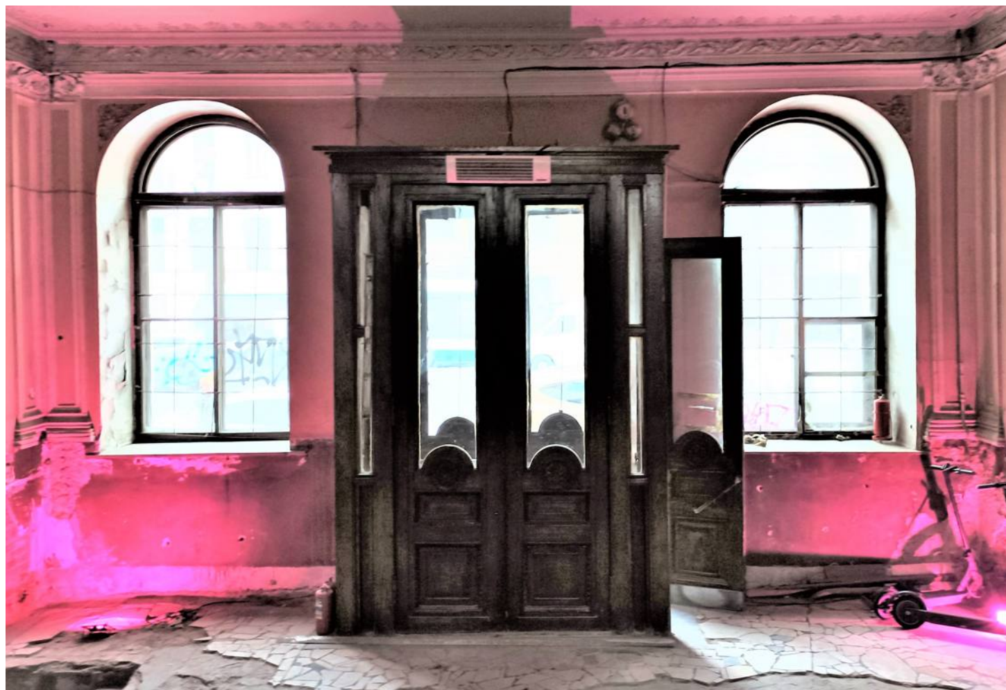
28. Объекта культурного наследия регионального значения «Дом С. С. Нарышкина», по адресу: Санкт-Петербург, Литейный проспект, дом 62, литера А (Литейный пр., 62). Детали и фрагменты стен вестибюля. Дата съемки: 12 октября 2021 г.
