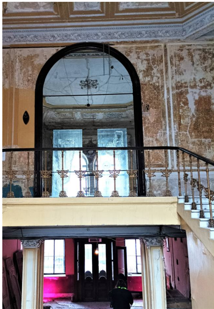
18. Объекта культурного наследия регионального значения «Дом С. С. Нарышкина», по адресу: Санкт-Петербург, Литейный проспект, дом 62, литера А (Литейный пр., 62). Парадная лестница. Фрагмент. Дата съемки: 12 октября 2021 г.
