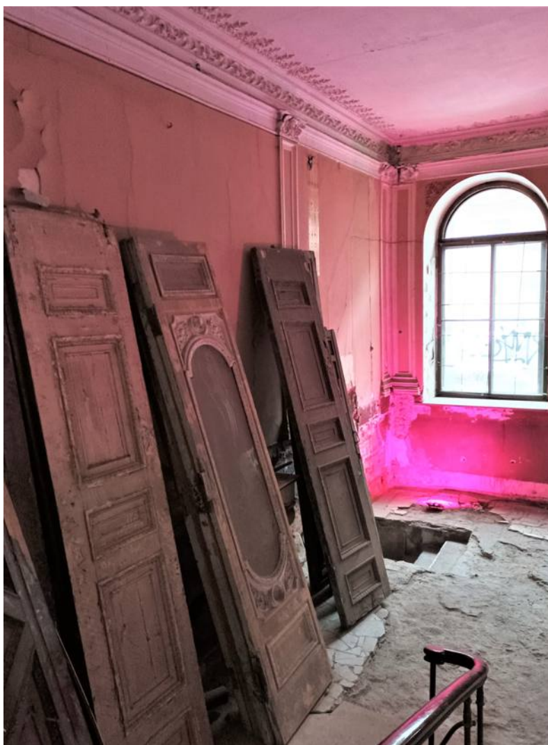
23. Объекта культурного наследия регионального значения «Дом С. С. Нарышкина», по адресу: Санкт-Петербург, Литейный проспект, дом 62, литера А (Литейный пр., 62). Вестибюль. Фрагмент. Дата съемки: 12 октября 2021 г.
