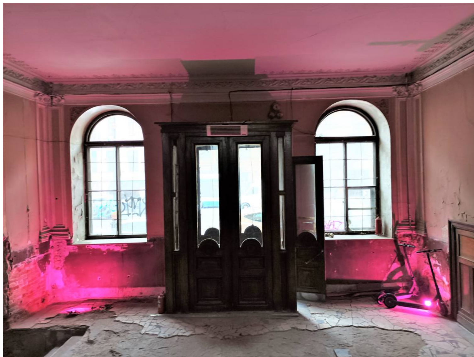
14. Объекта культурного наследия регионального значения «Дом С. С. Нарышкина», по адресу: Санкт-Петербург, Литейный проспект, дом 62, литера А (Литейный пр., 62). Вестибюль. Общий вид. Дата съемки: 12 октября 2021 г.
