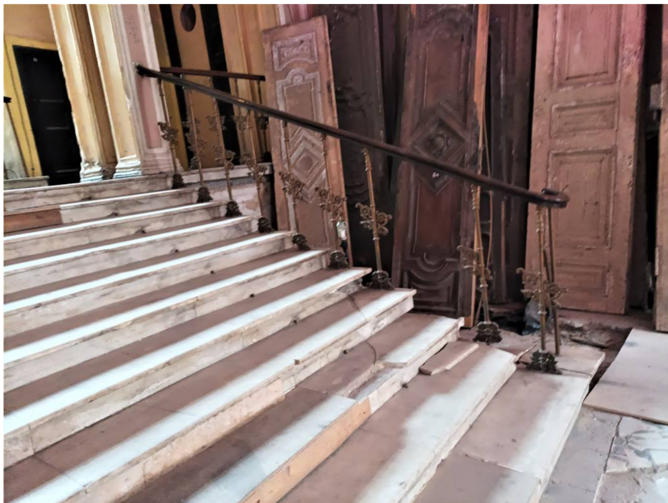
22. Объекта культурного наследия регионального значения «Дом С. С. Нарышкина», по адресу: Санкт-Петербург, Литейный проспект, дом 62, литера А (Литейный пр., 62). Парадная лестница. Фрагмент. Дата съемки: 12 октября 2021 г.
