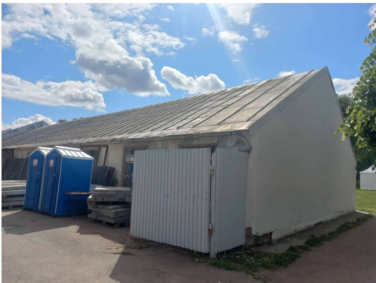
Фото 6. Здание деревообрабатывающей мастерской. Западный (торцевой) фасад. Ограждение территории.
