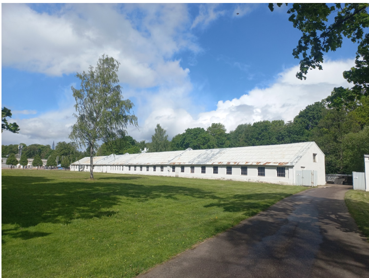
Фото 9. Восточный (торцевой) фасад, северный фасад (фрагмент). Въезд на территорию.
