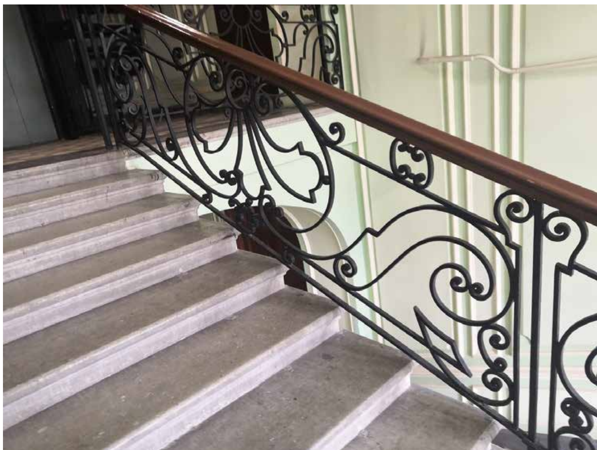
64. Фрагмент ограждения парадной лестницы в уровне 5-6-го этажей
