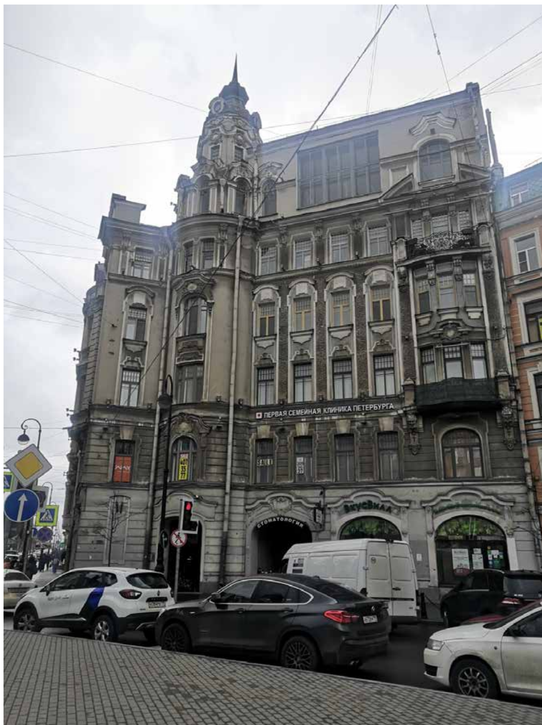
13. Лицевой фасад по Австрийской площади
