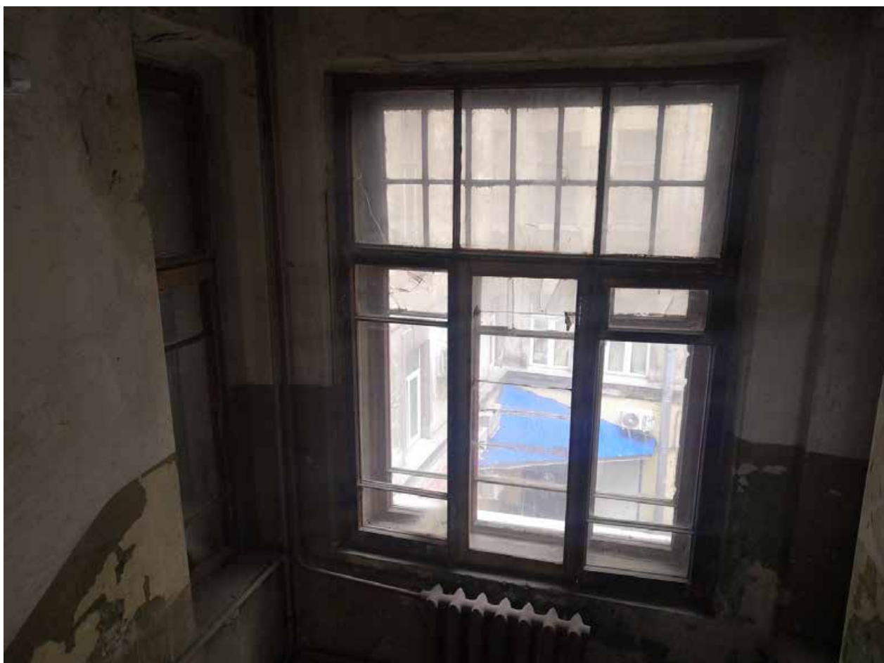
89. Лестница Л-2 в уровне 2-3-го этажей. Оконный проем
