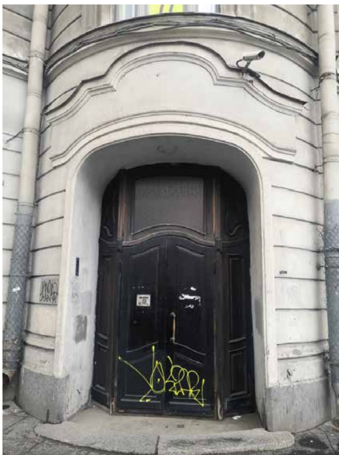
20. Фрагмент лицевого фасада по Австрийской площади. Оформление дверного проема на парадную лестницу башни
