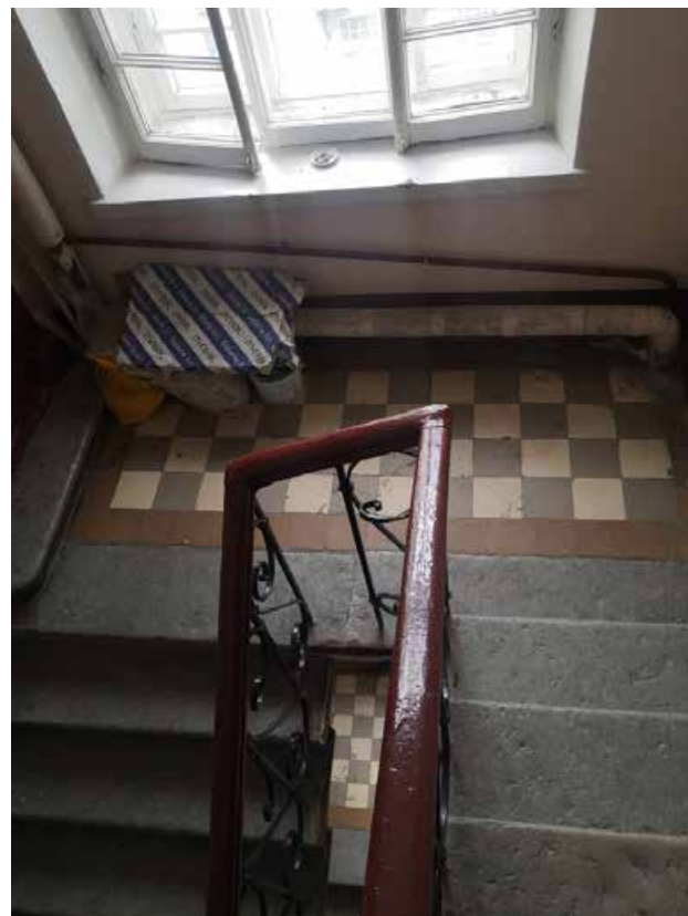
116. Лестница Л-3 в уровне 5-6-го этажей
