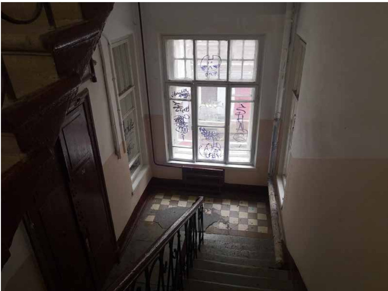
106. Лестница Л-3 в уровне 2-3-го этажей
