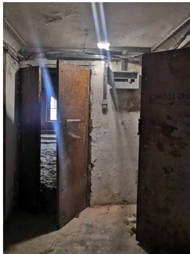
96. Помещение чердака над лестницей Л-2
