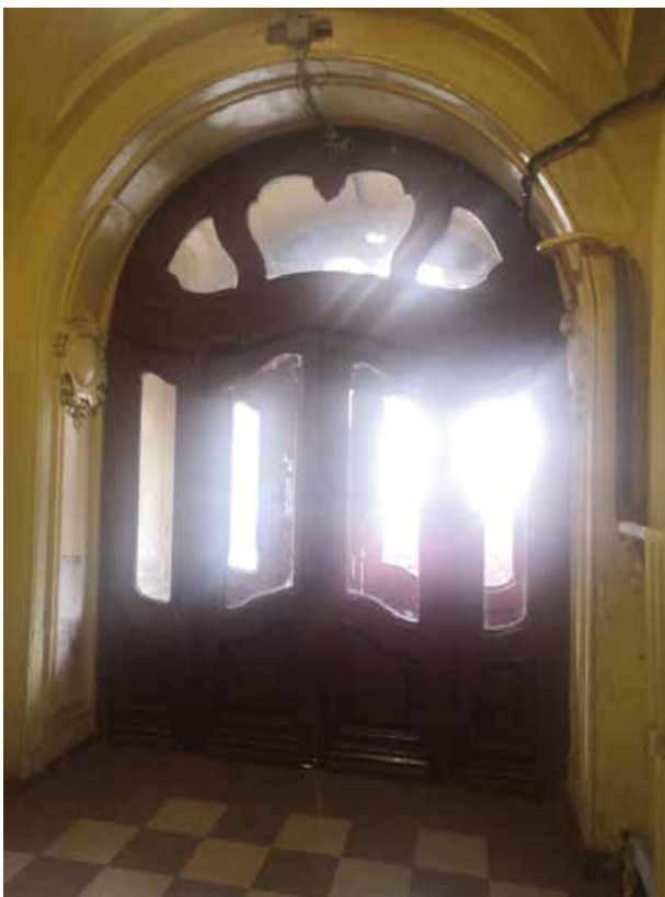
69. Парадный вестибюль лестницы Л-1. Внутреннее дверное заполнение тамбура с исторической фрамугой
