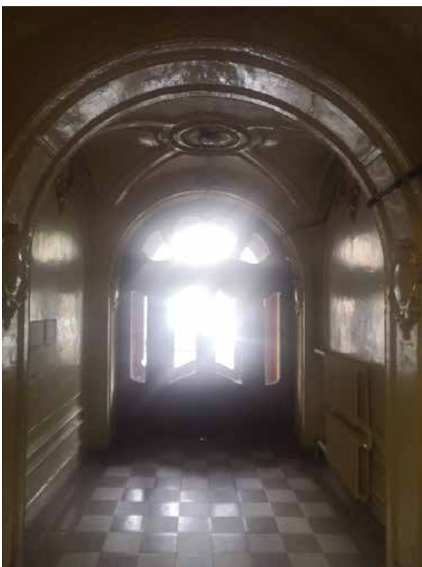
71. Парадный вестибюль лестницы Л-1. Полуциркульные своды с подпружными арками и крестовым сводом с розеткой
