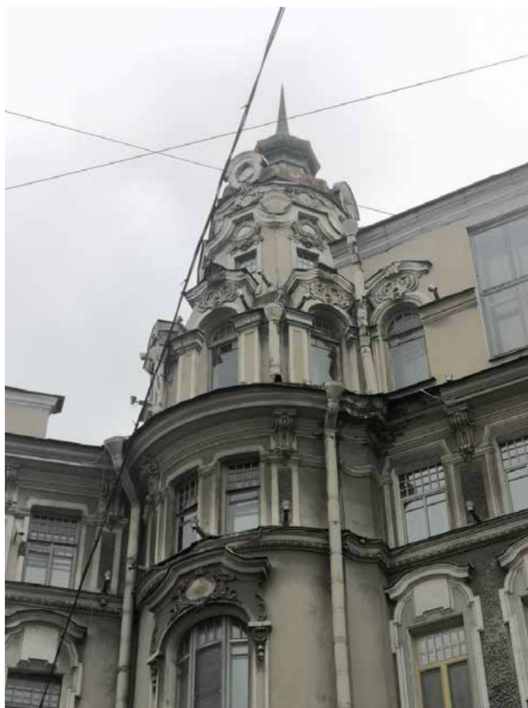
15. Завершение башни лицевого фасада по Австрийской площади
