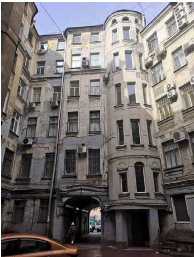
23. Фрагмент дворового фасада
