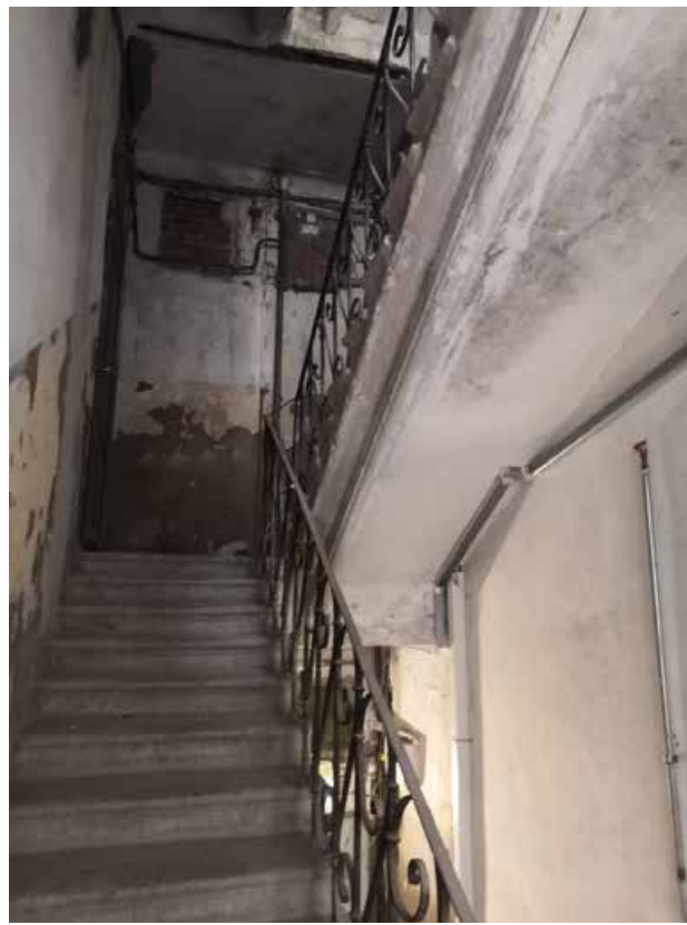
88. Лестница Л-2 в уровне 2-3-го этажей
