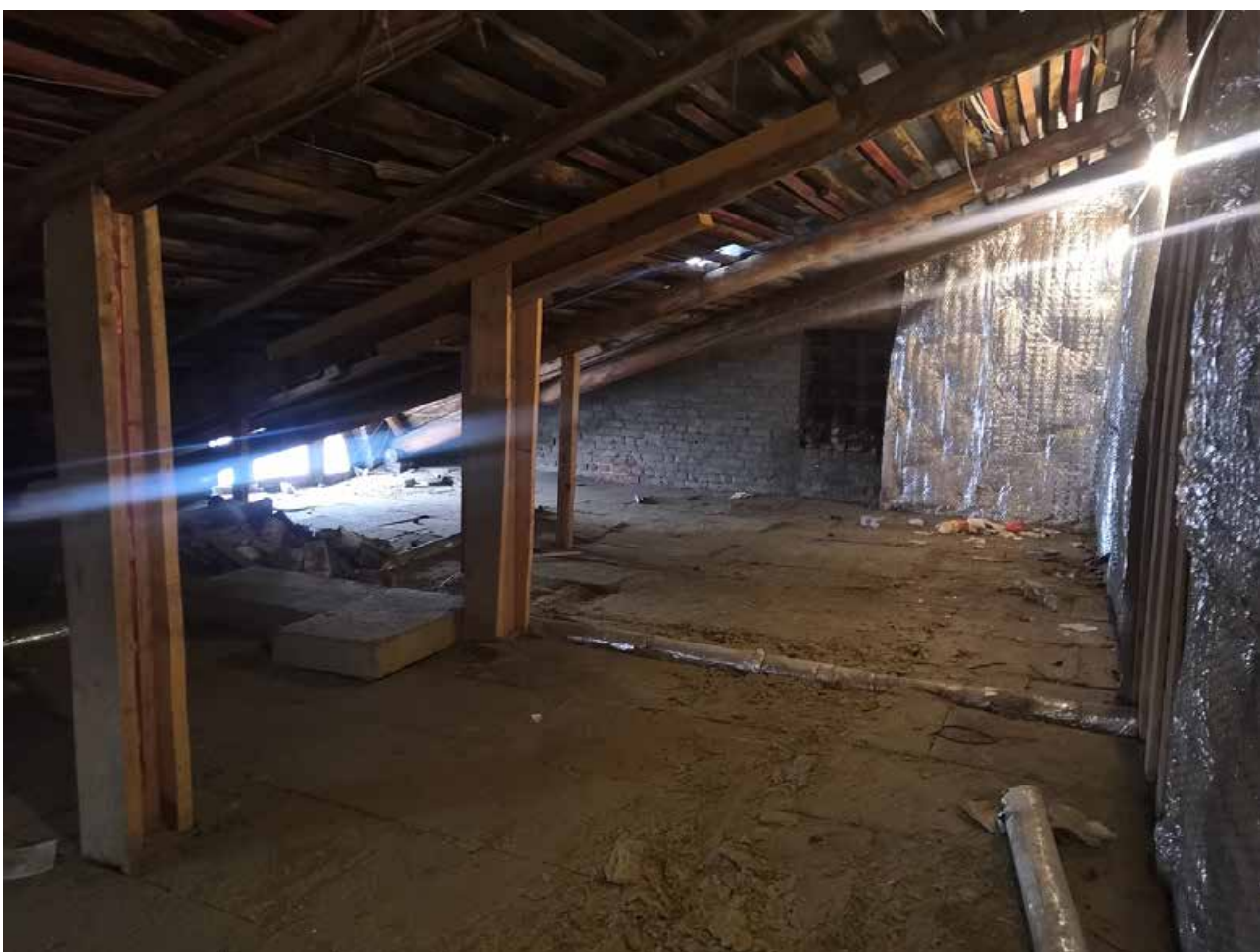
97. Помещение чердака над лестницей Л-2
