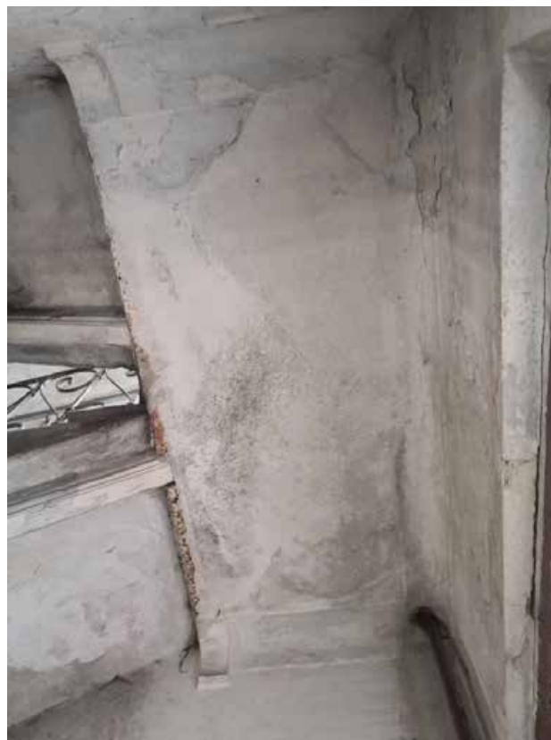
86. Лестница Л-2 в уровне 1-2-го этажей
