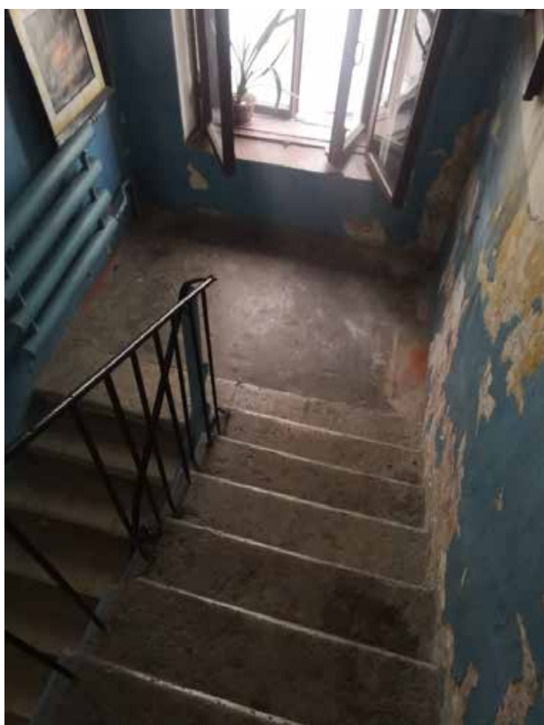
124. Лестница Л-4 в уровне 2-3-го этажей
