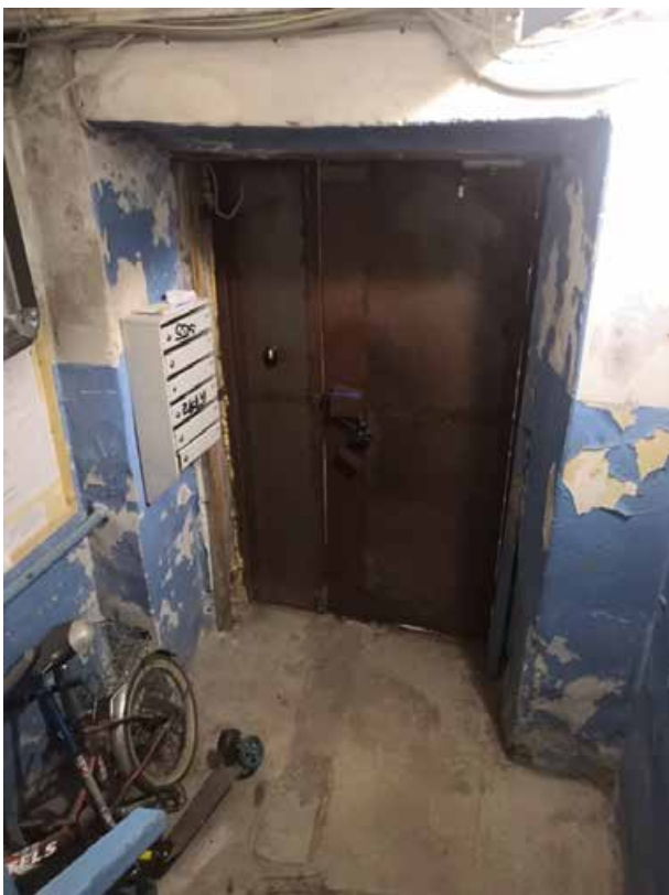
119. Тамбур лестницы Л-4
