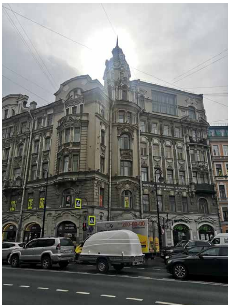
12. Фрагмент лицевых фасадов
