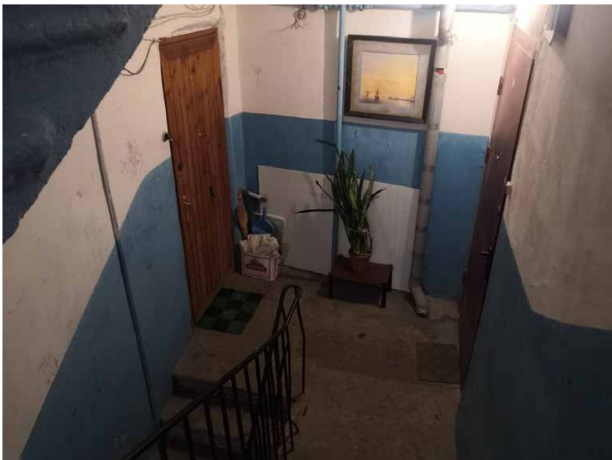
123. Лестница Л-4 в уровне 2-го этажа
