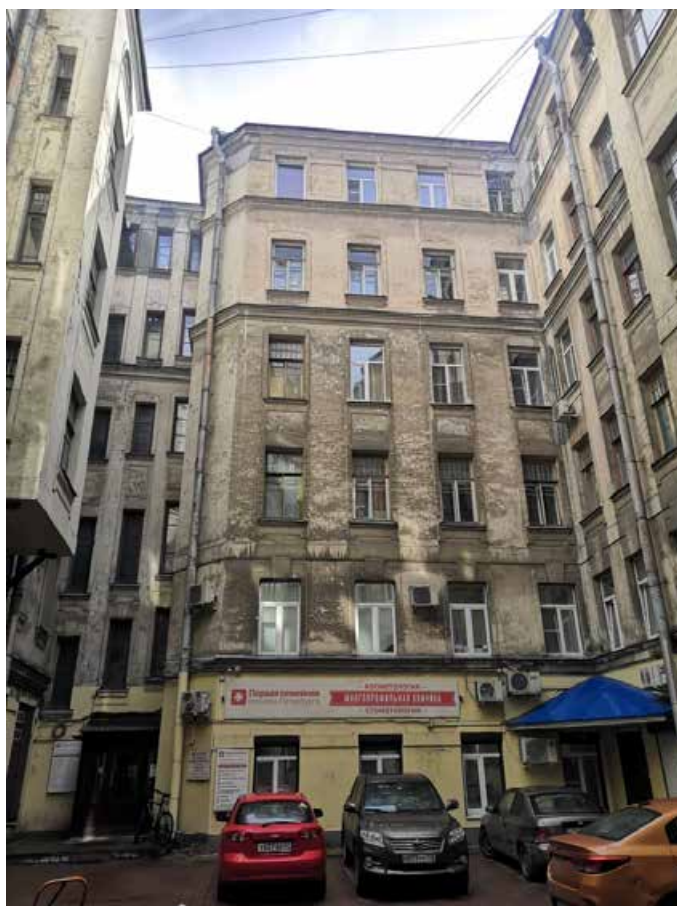
27. Фрагмент дворового фасада
