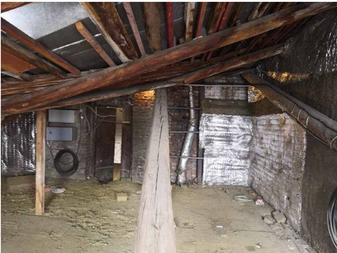
98. Помещение чердака над лестницей Л-2
