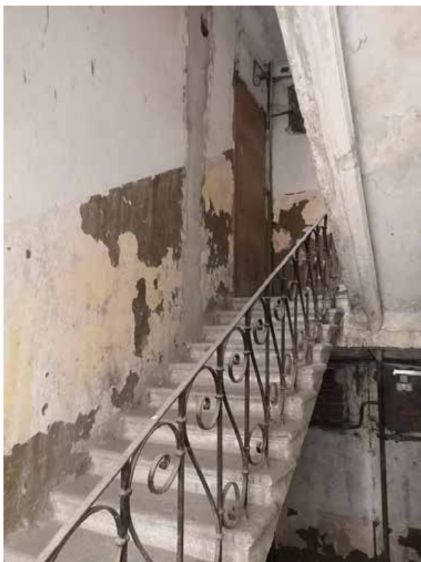
90. Лестница Л-2 в уровне 3-4-го этажей
