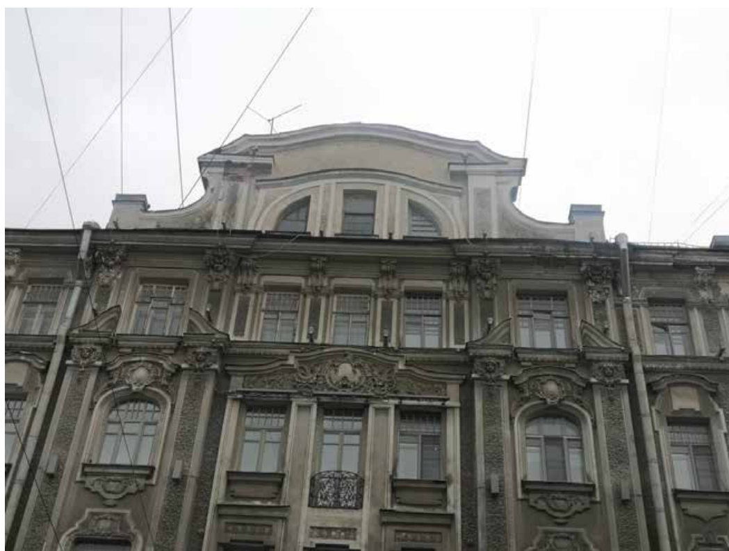
6. Завершение центральной части лицевого фасада по Каменноостровскому проспекту
