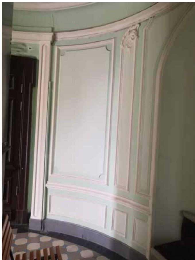
61. Фрагмент интерьера парадной лестницы в уровне 3-го этажа
