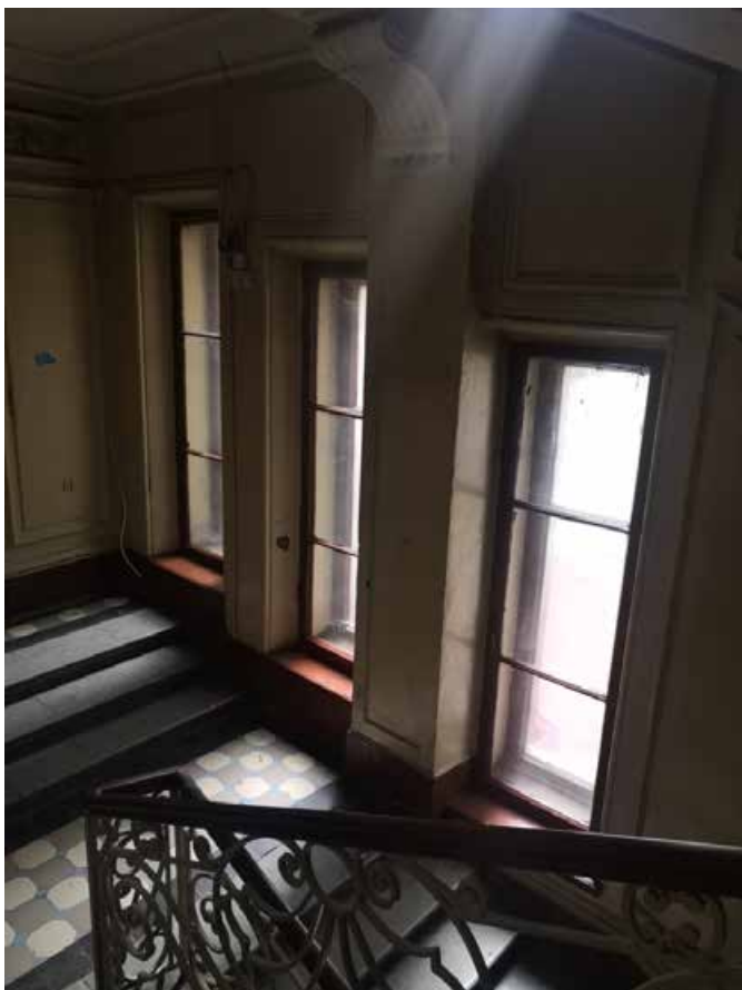
77. Лестница Л-1 в уровне 2-го этажа. Оконные проемы
