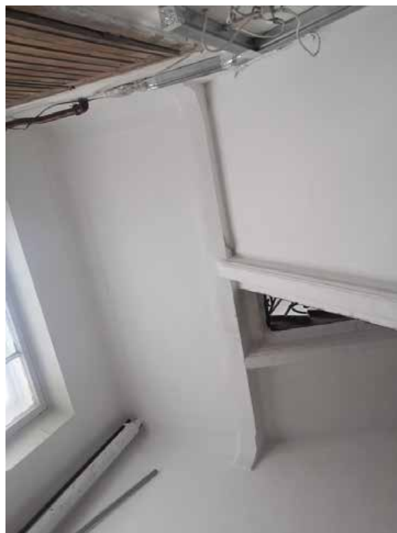
114. Лестница Л-3 в уровне 4-5-го этажей
