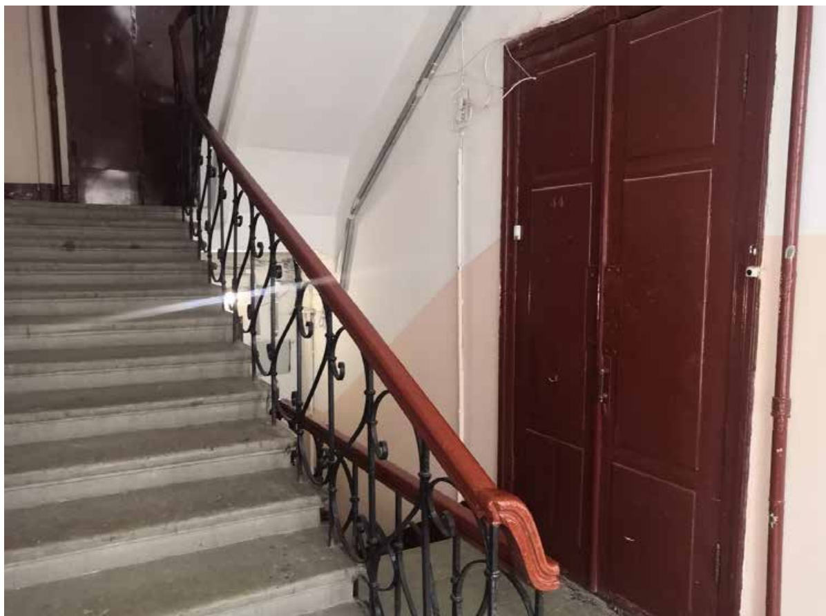
109. Лестница Л-3 в уровне 3-4-го этажей
