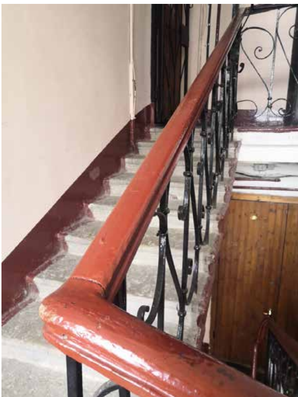
117. Лестница Л-3 в уровне 5-6-го этажей
