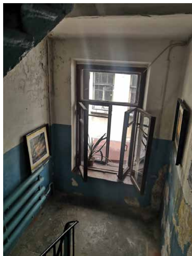
125. Лестница Л-4 в уровне 2-3-го этажей
