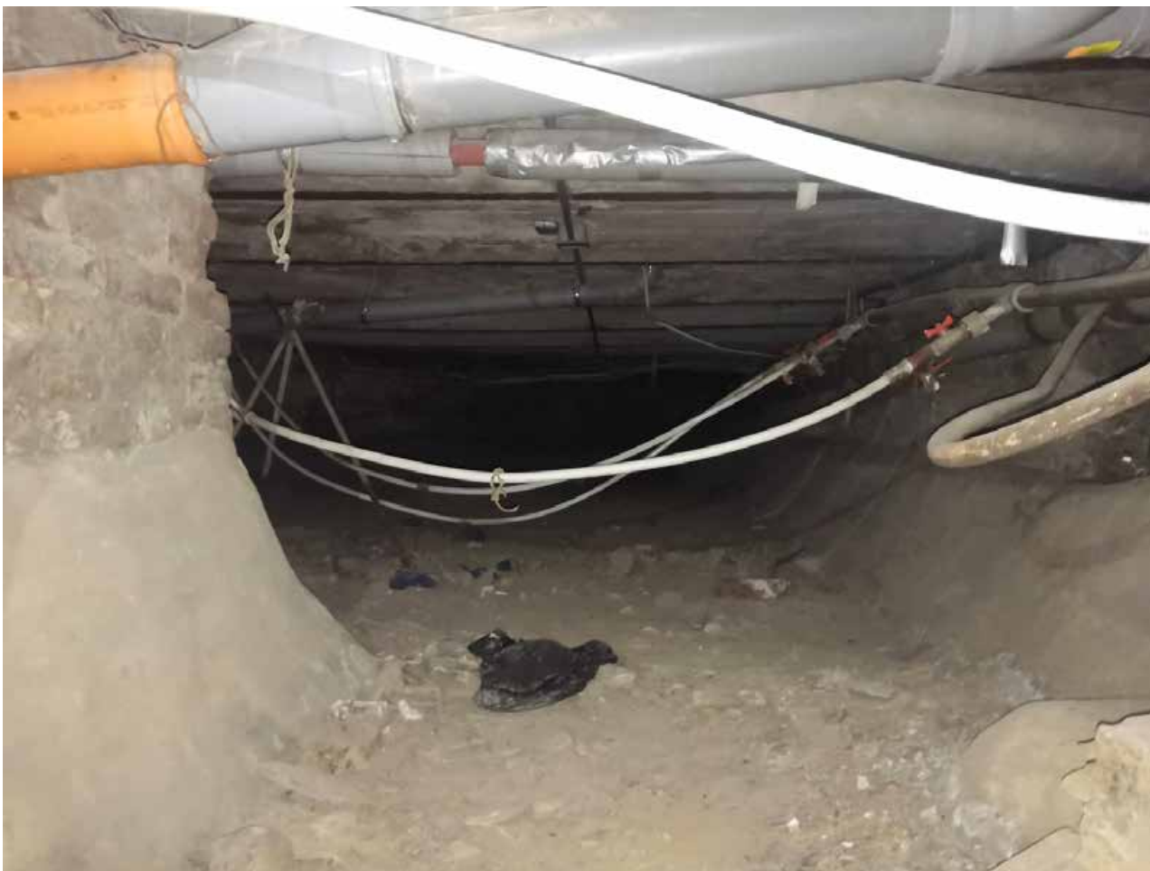
101. Помещение чердака над лестницей Л-2
