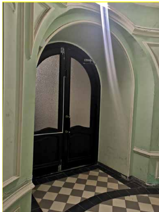
51. Дверной проем вестибюля парадной лестницы
