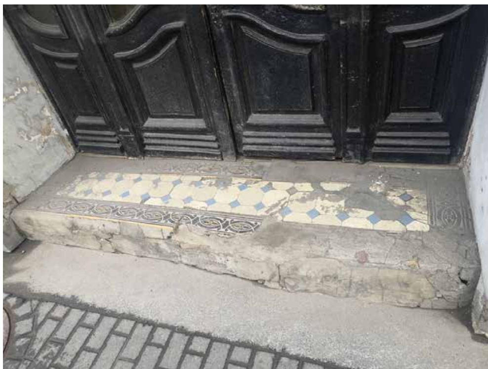
11. Фрагмент лицевого фасада по Каменноостровскому проспекту. Фрагмент метлахской плитки перед парадным входом
