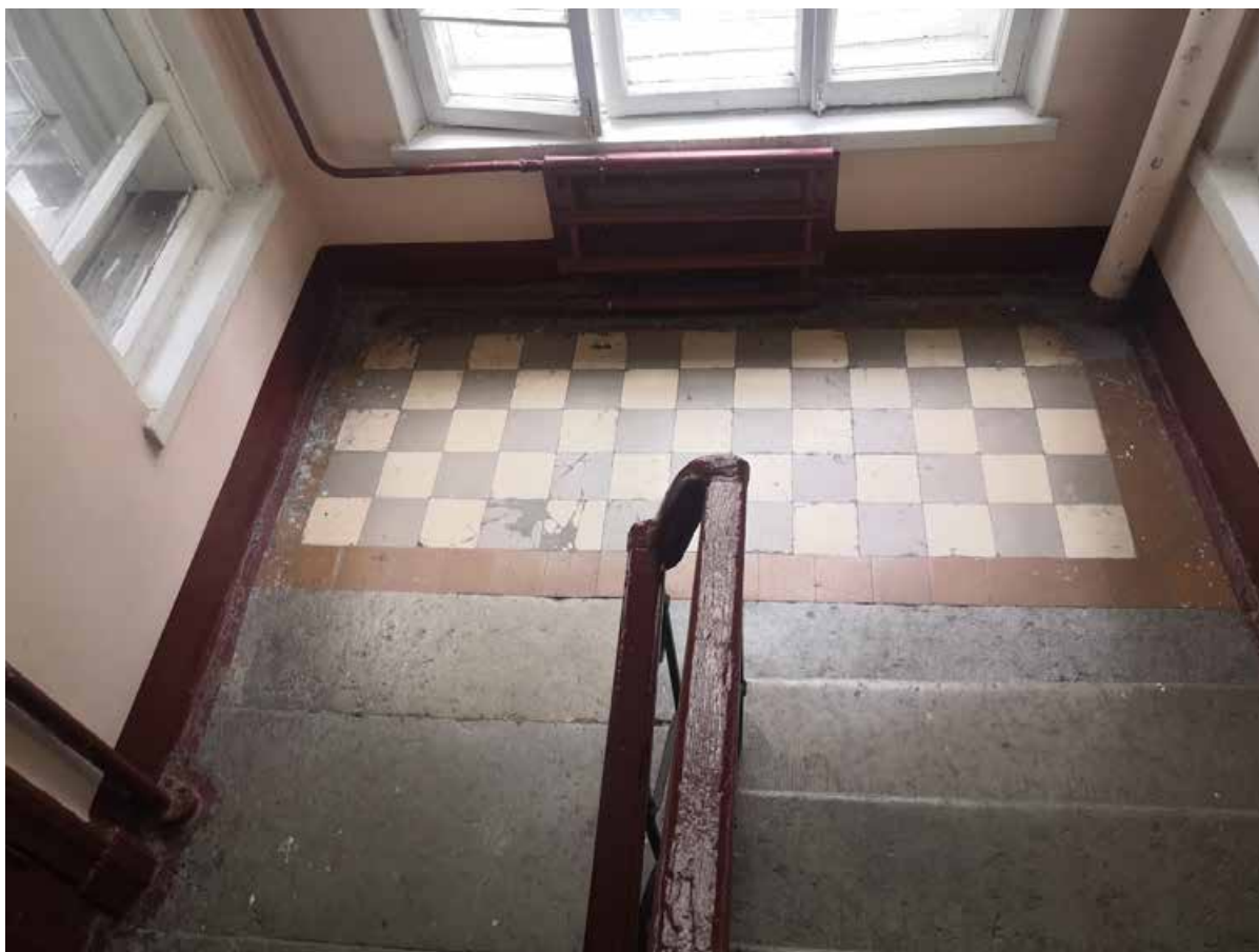
110. Лестница Л-3 в уровне 3-4-го этажей
