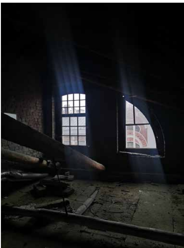
99. Помещение чердака над лестницей Л-2
