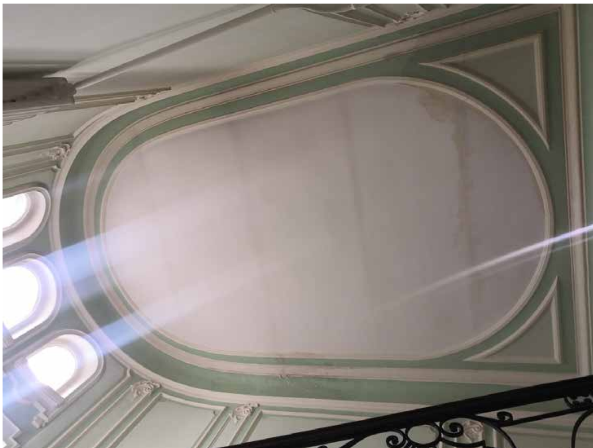
66. Потолок парадной лестницы в уровне 6-го этажа
