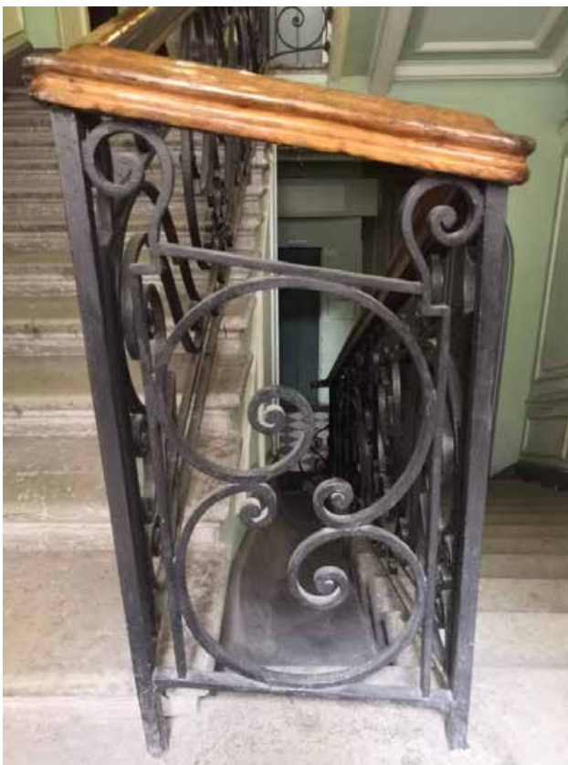
56. Фрагмент ограждения парадной лестницы в уровне 1-2-го этажей
