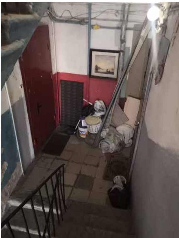
126. Лестница Л-4 в уровне 3-го этажа
