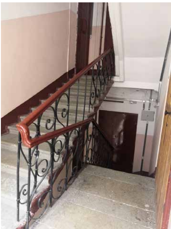
113. Лестница Л-3 в уровне 4-5-го этажей
