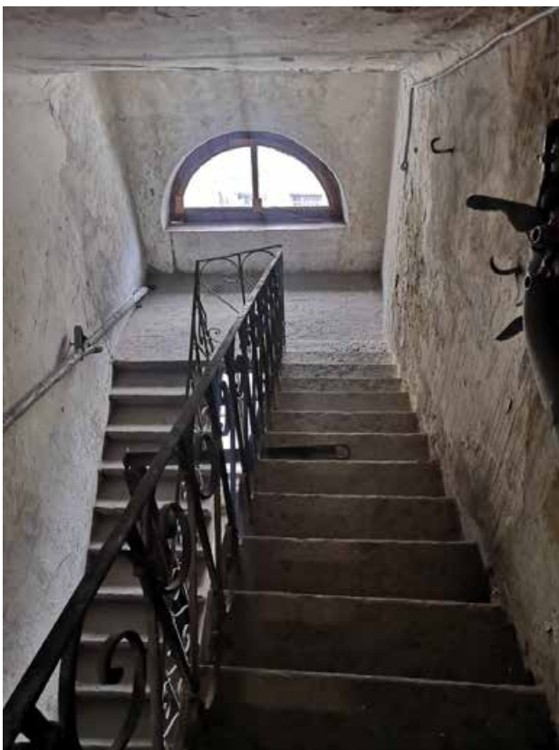
95. Лестница Л-2 в уровне 5-6-го этажей
