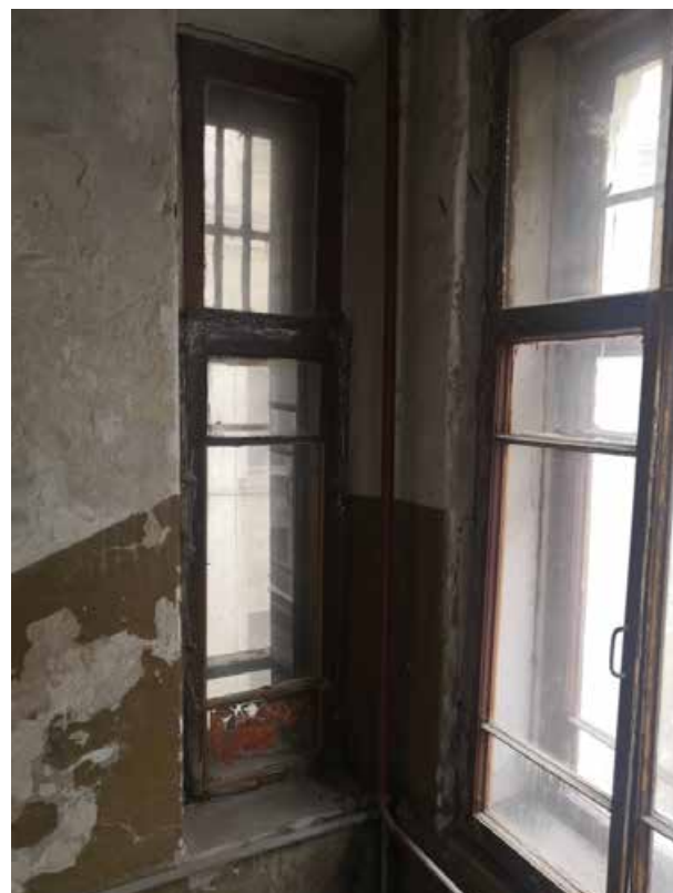
91. Лестница Л-2 в уровне 3-4-го этажей. Оконные проемы
