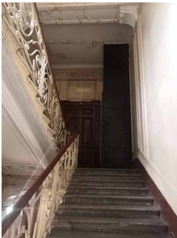
81. Лестница Л-1 в уровне 4-5-го этажей
