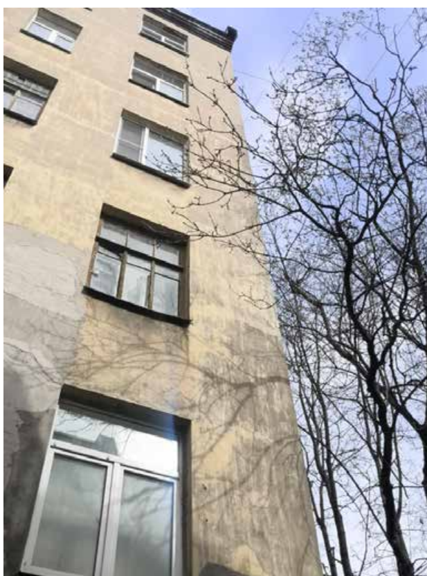
33. Фрагмент дворового фасада
