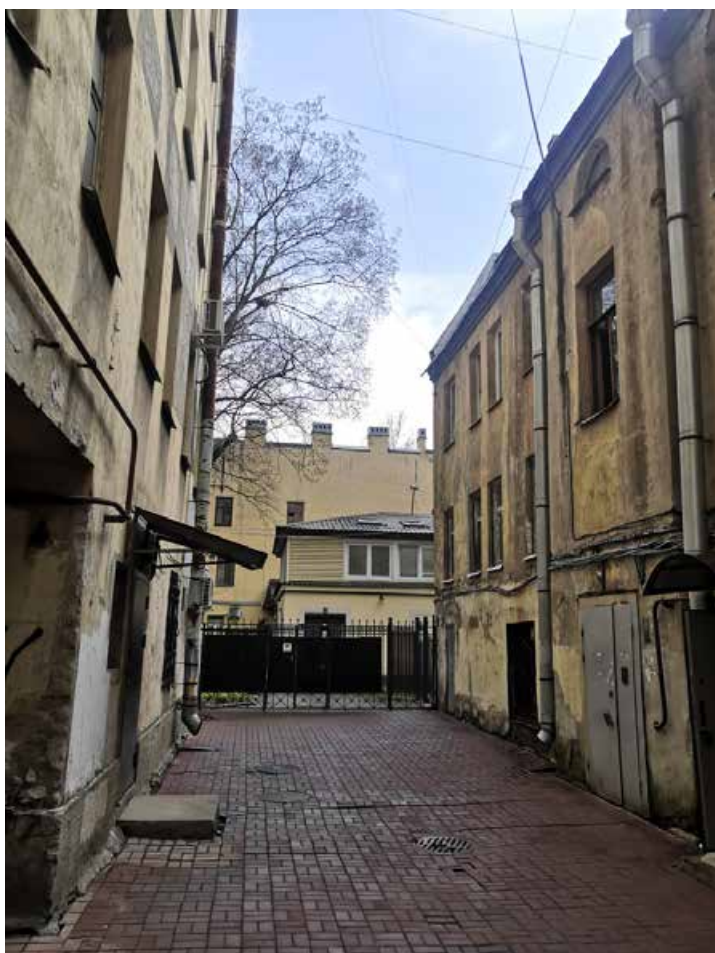
35. Фрагмент дворовых фасадов
