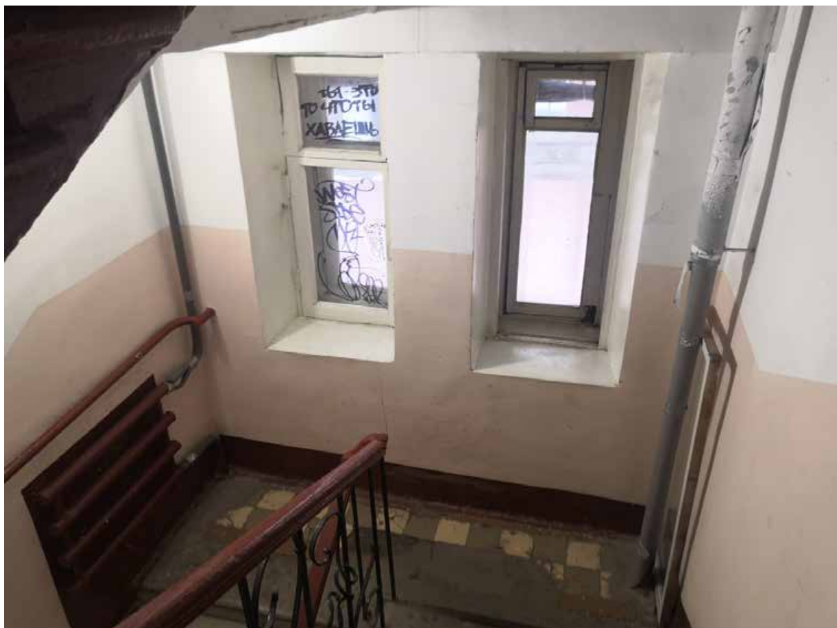
105. Лестница Л-3 в уровне 1-2-го этажей
