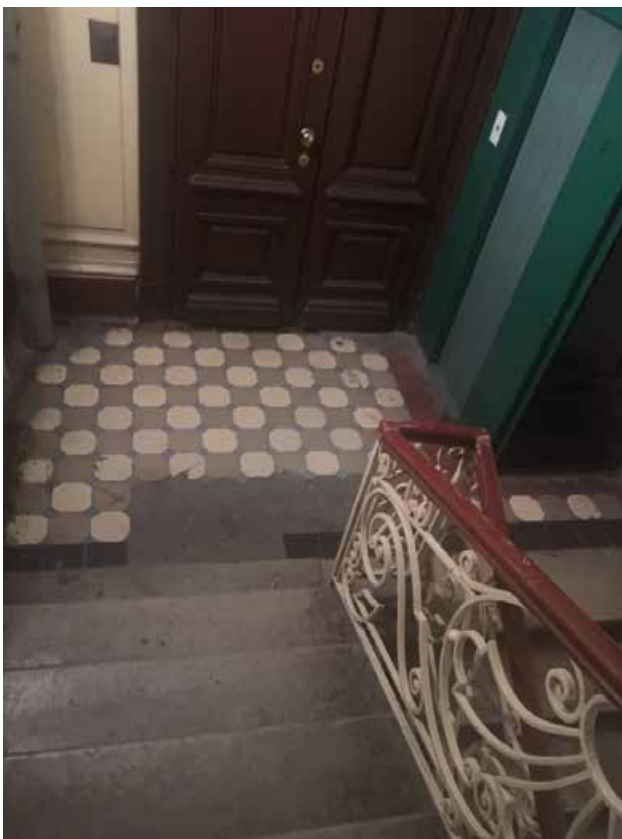
73. Лестница Л-1 в уровне 1-2-го этажей
