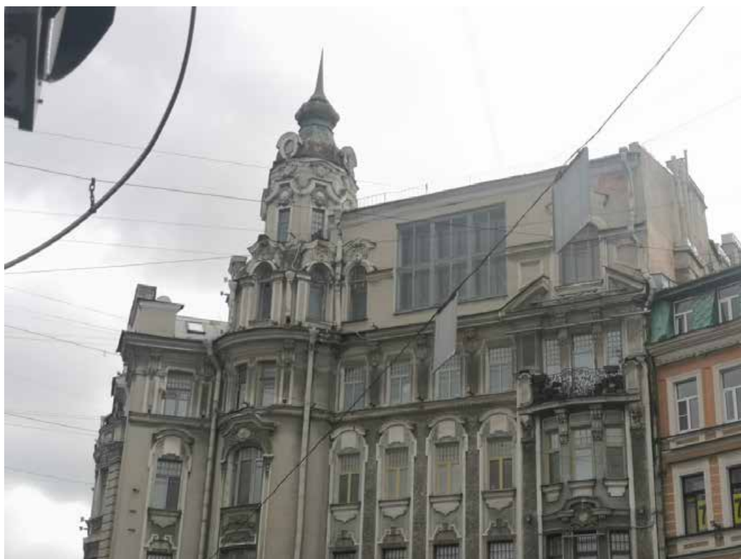
14. Фрагмент лицевого фасада по Австрийской площади
