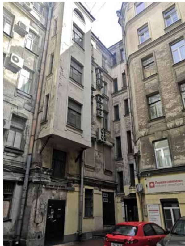
26. Фрагмент дворового фасада. Прямоугольный в плане эркер на чугунных кронштейнах на уровне 3-5-го этажа
