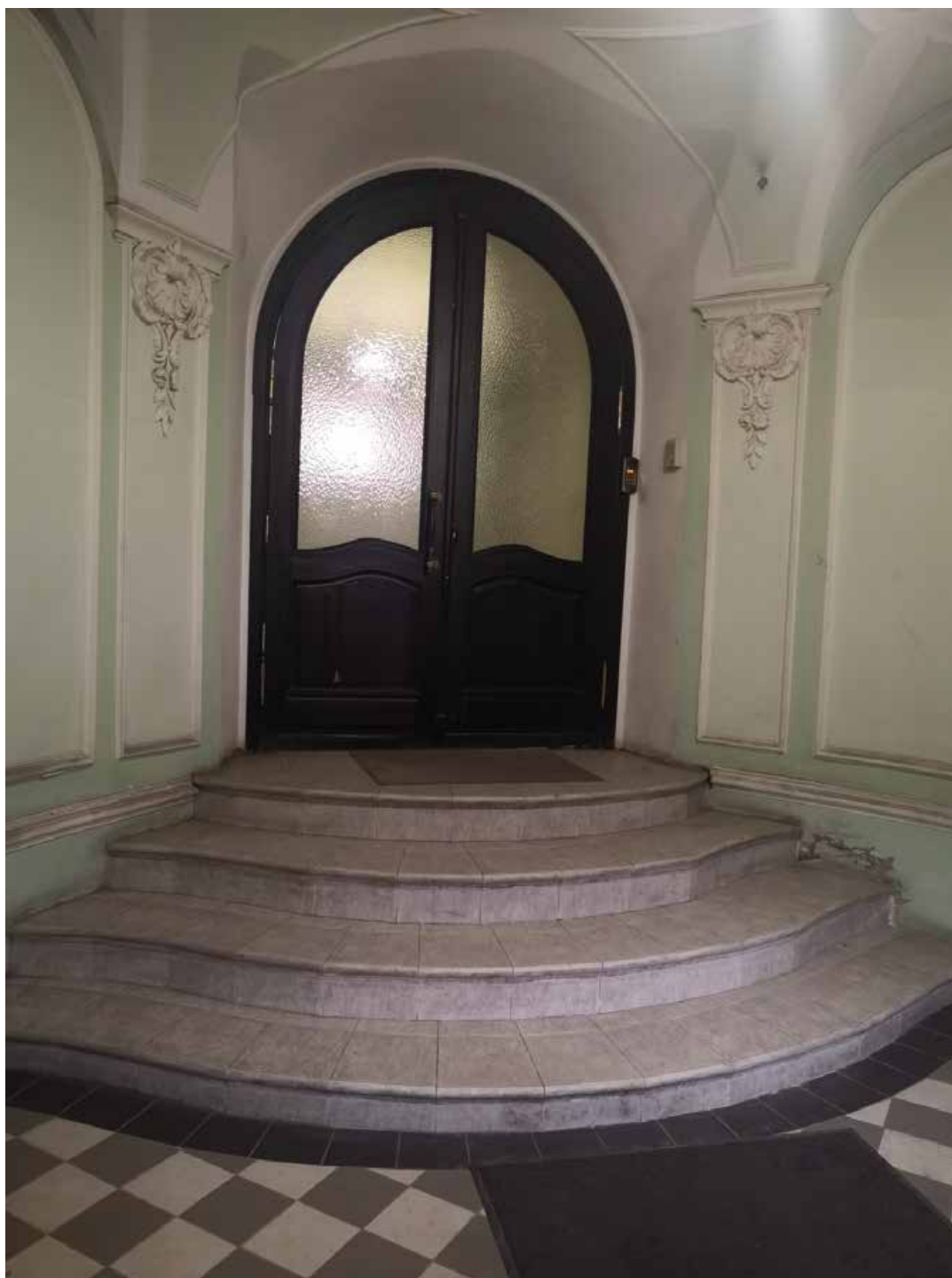
49. Тамбур парадной лестницы
