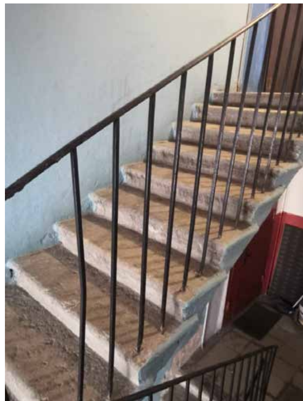
127. Лестница Л-4 в уровне 3-4-го этажей
