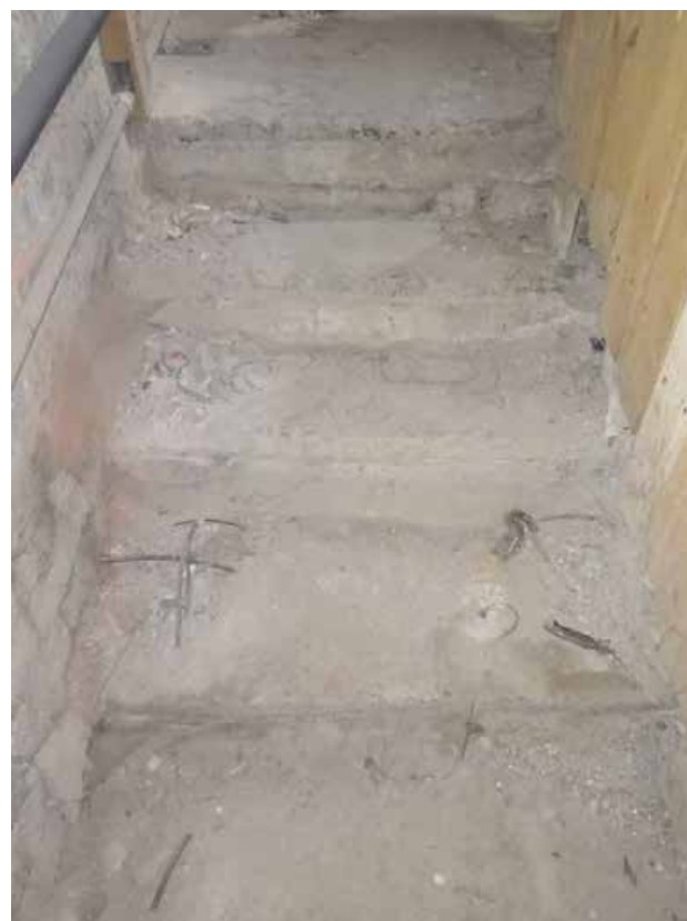
100. Помещение чердака над лестницей Л-2
