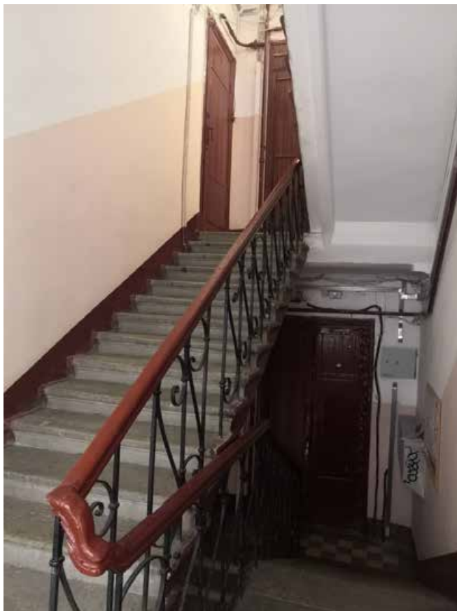
104. Лестница Л-3 в уровне 1-2-го этажей
