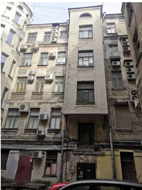
25. Фрагмент дворового фасада
