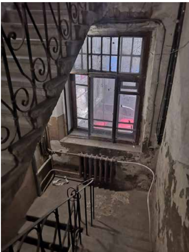
85. Лестница Л-2 в уровне 1-2-го этажей
