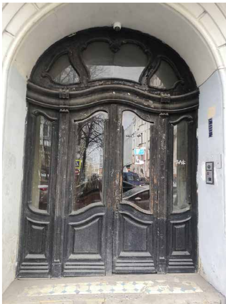
9. Фрагмент лицевого фасада по Каменноостровскому проспекту. Проем парадного входа под южным эркером с историческим дверным заполнением фигурной расстекловки
