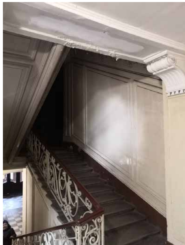
74. Лестница Л-1 в уровне 1-2-го этажей
