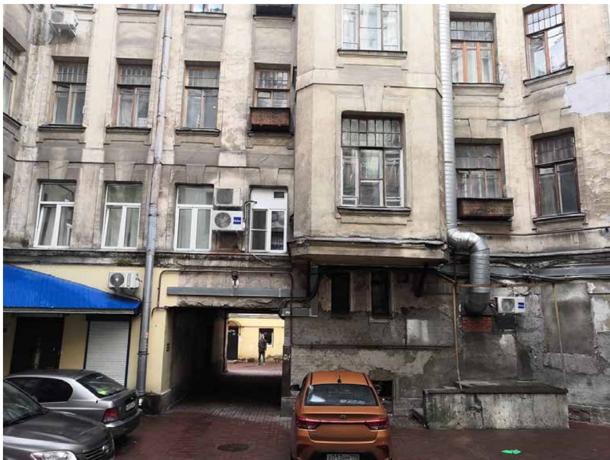
28. Фрагмент дворового фасада
