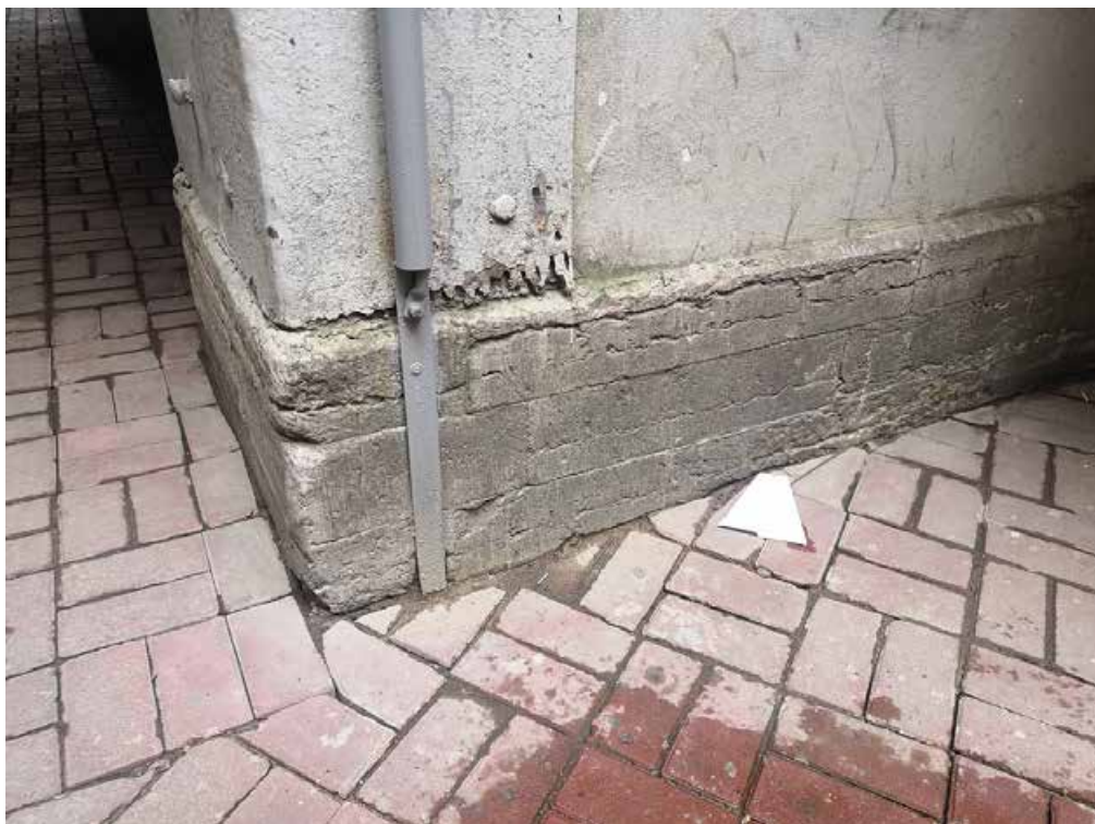
30. Фрагмент дворового фасада. Известняковый цоколь
