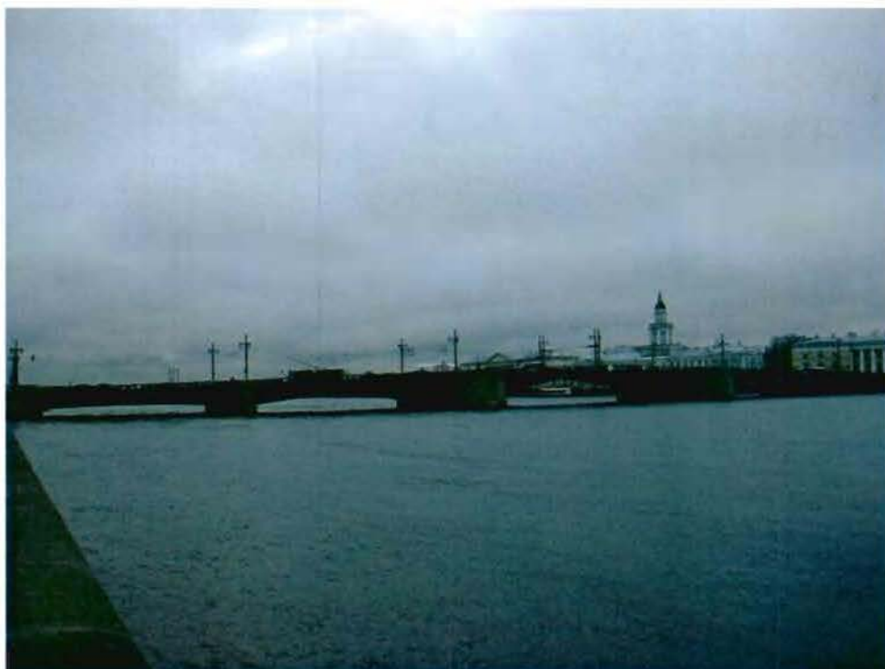
1. Вид на мост со стороны верхового фасада
