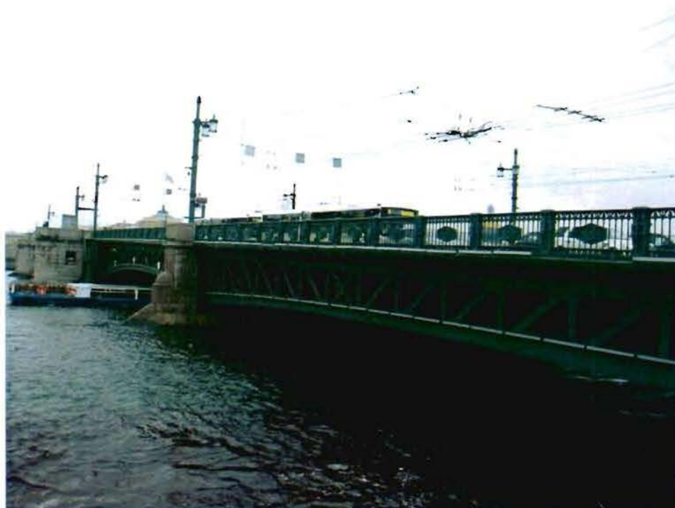
2. Пролётное строение моста. Вид со стороны верхового фасада
