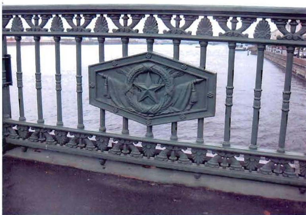
7. Решётка перильного ограждения. Фрагмент
