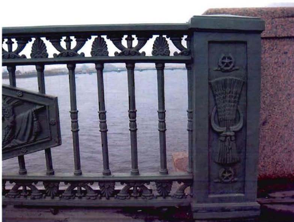
8. Решётка перильного ограждения. Фрагмент
