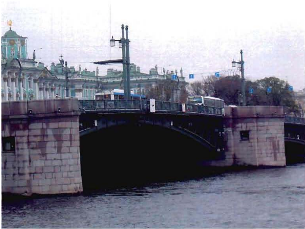
3. Разводной пролёт моста. Вид со стороны низового фасада
