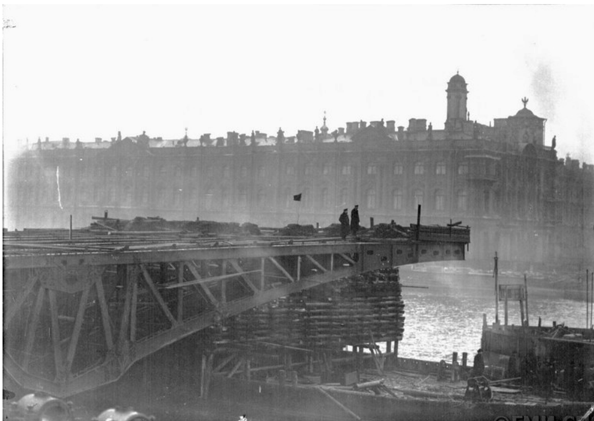
15. Постройка нового Дворцового моста. 1911 - 1913 г. г. — «PastVu» – ретро-фотографии стран и городов [Электронный ресурс]. URL: https://pastvu.com/p/1445743 .
