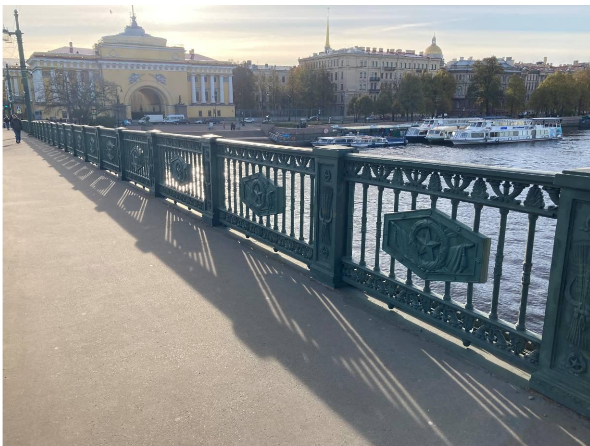
Фото 4. Объект культурного наследия регионального значения «Дворцовый мост», вид на ограждения моста
