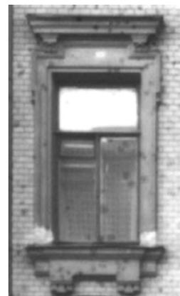
оформление оконных проемов 4-го этажа – профилированные раскрепованные наличники, замковые камни в виде волют и лавровых гирлянд, профилированные подоконные доски с штукатурным зеркалом;
