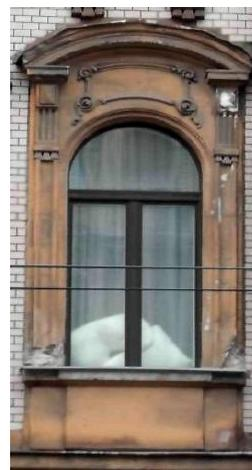
оформление оконных проемов 3-го этажа - профилированные раскрепованные наличники, стилизованные полотенца с гуттами в подоконном пространстве, плоские профилированные сандрики на двух консолях;
