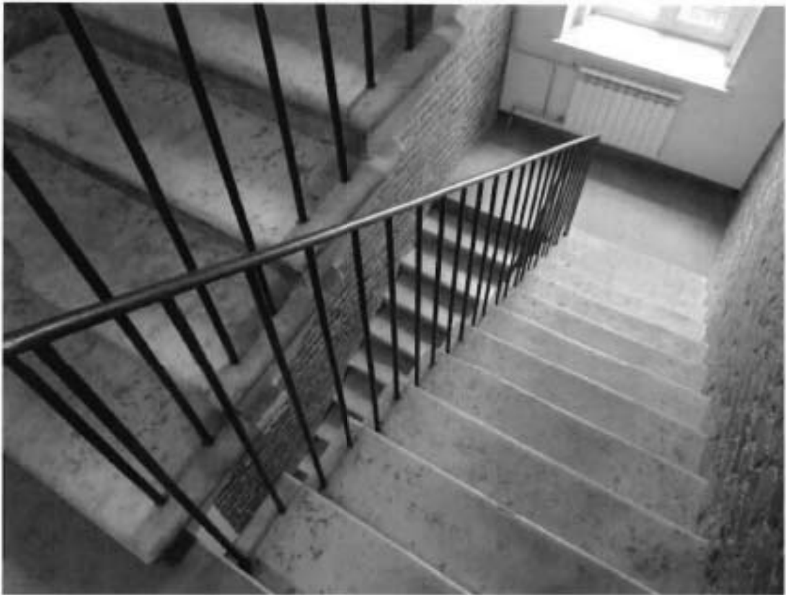
4. Лестница Л-1 объекта культурного наследия
