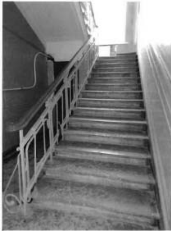
6. Парадная лестница Л-2 объекта культурного наследия
