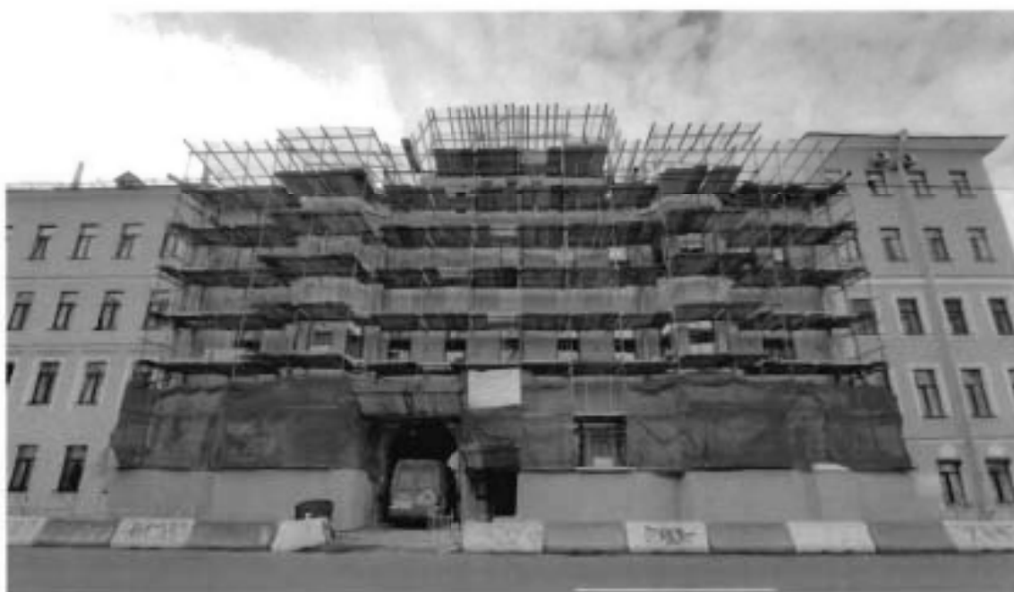
1. Общий вид на северный фасад объекта культурного наследия
