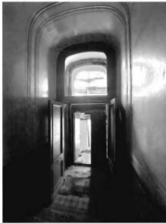
5. Тамбур и вестибюль парадной лестницы Л-2 объекта культурного наследия
