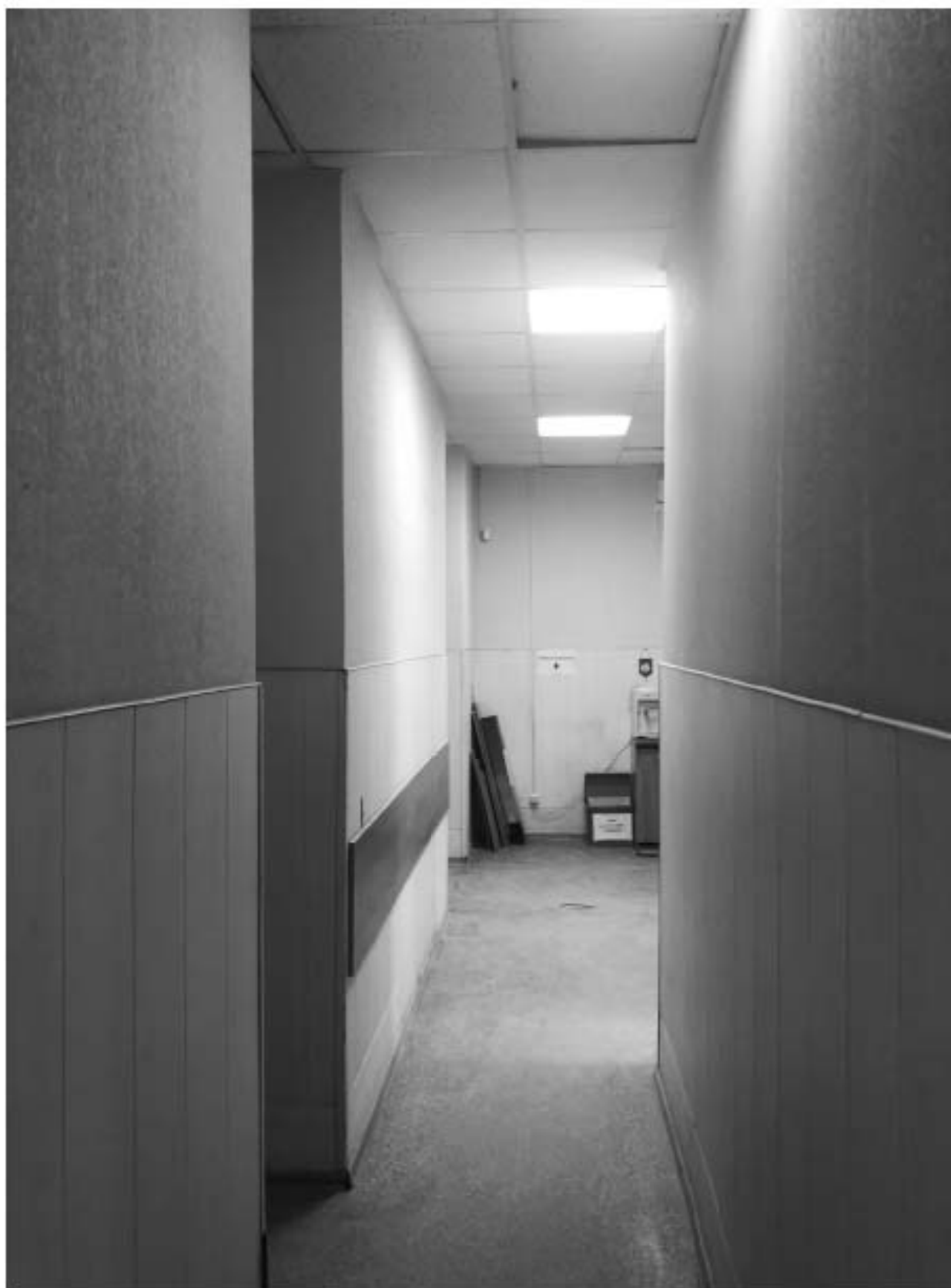
12. Фрагмент интерьера коридора (помещение 3/21.9);
