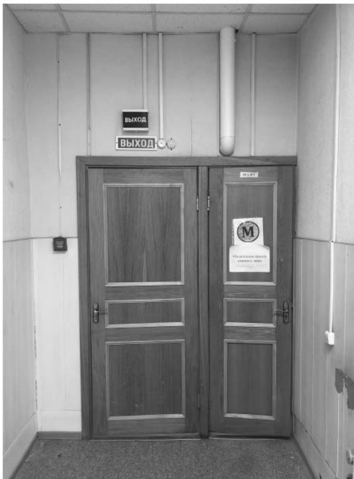
4. Вид на входную дверь в помещении.
