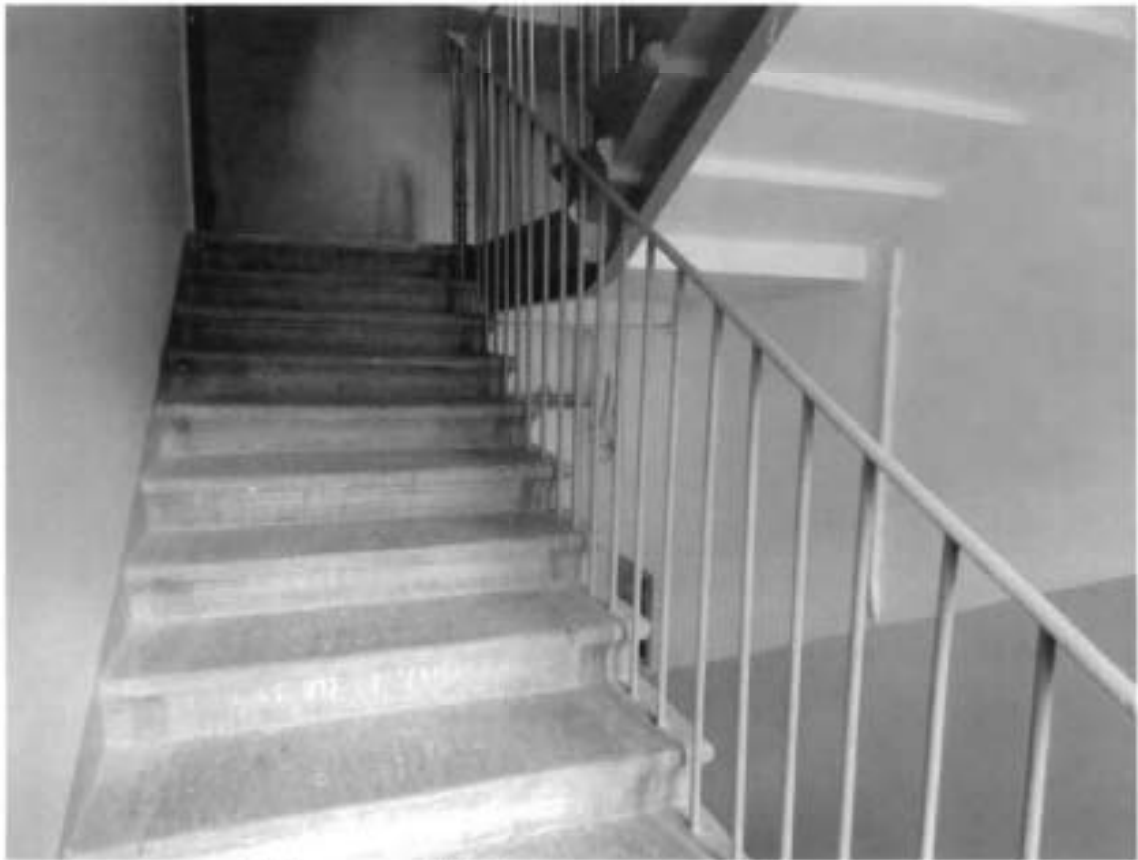
7. Лестница Л-3 объекта культурного наследия
