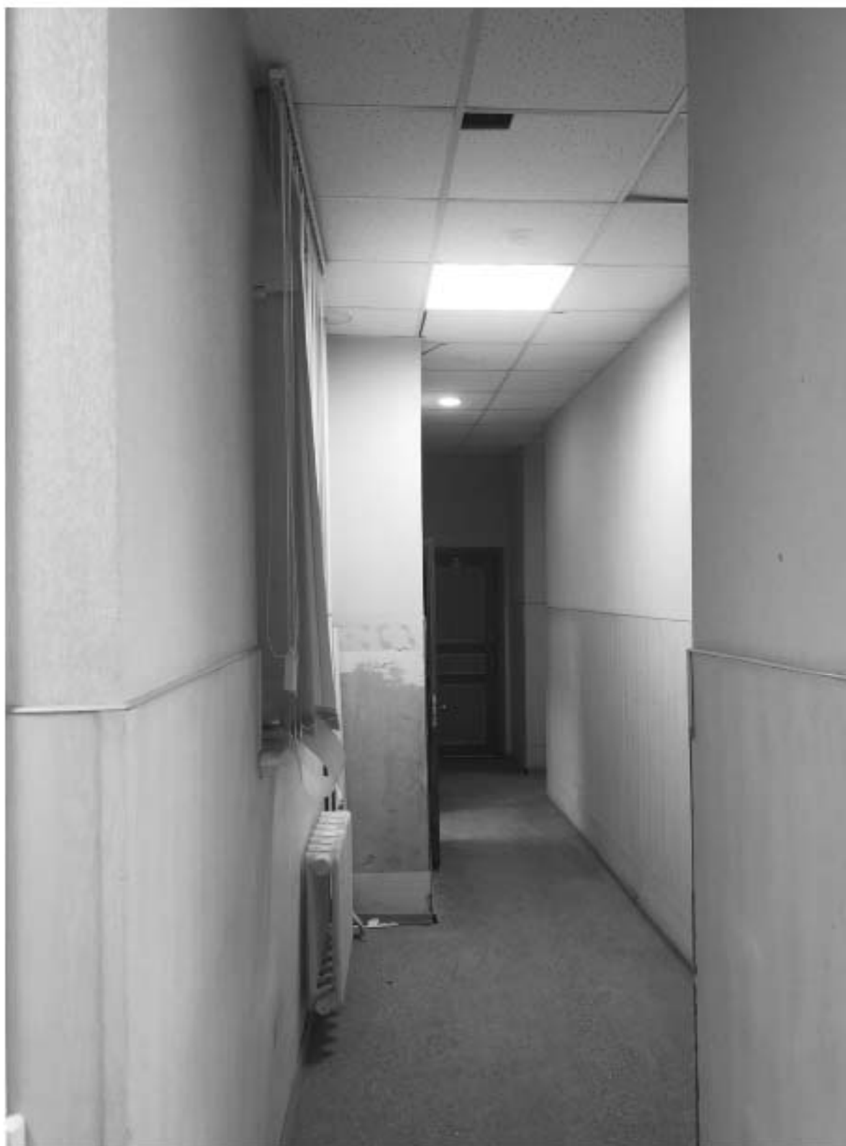
7. Фрагмент интерьера коридора (помещение 3/21.9);
