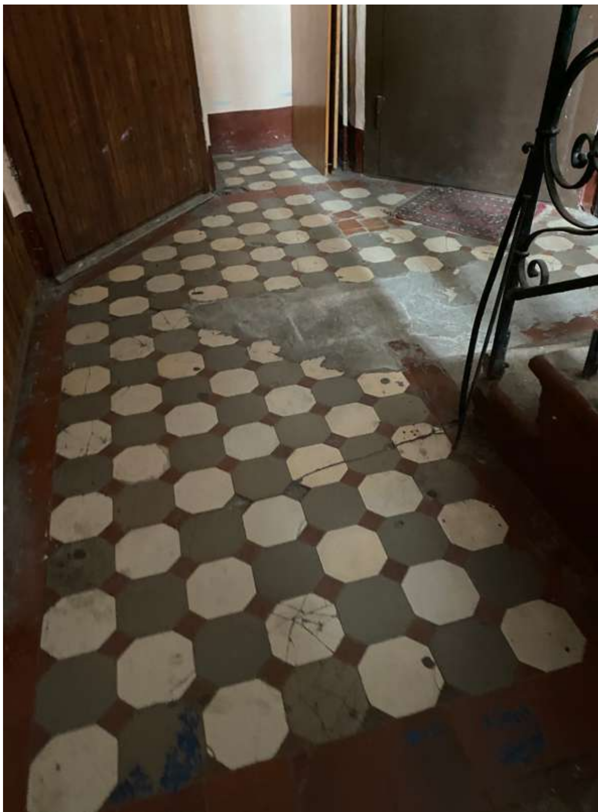
128. Фрагмент интерьера лестницы 1ЛК литеры Д
