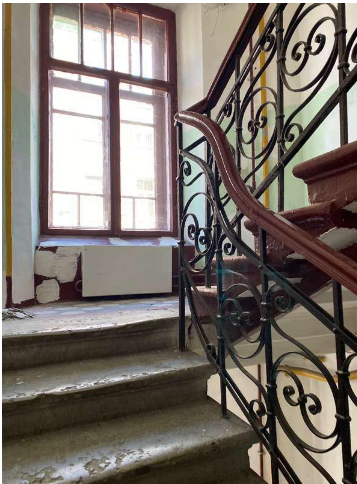
123. Фрагмент интерьера лестницы 2ЛК литеры Г
