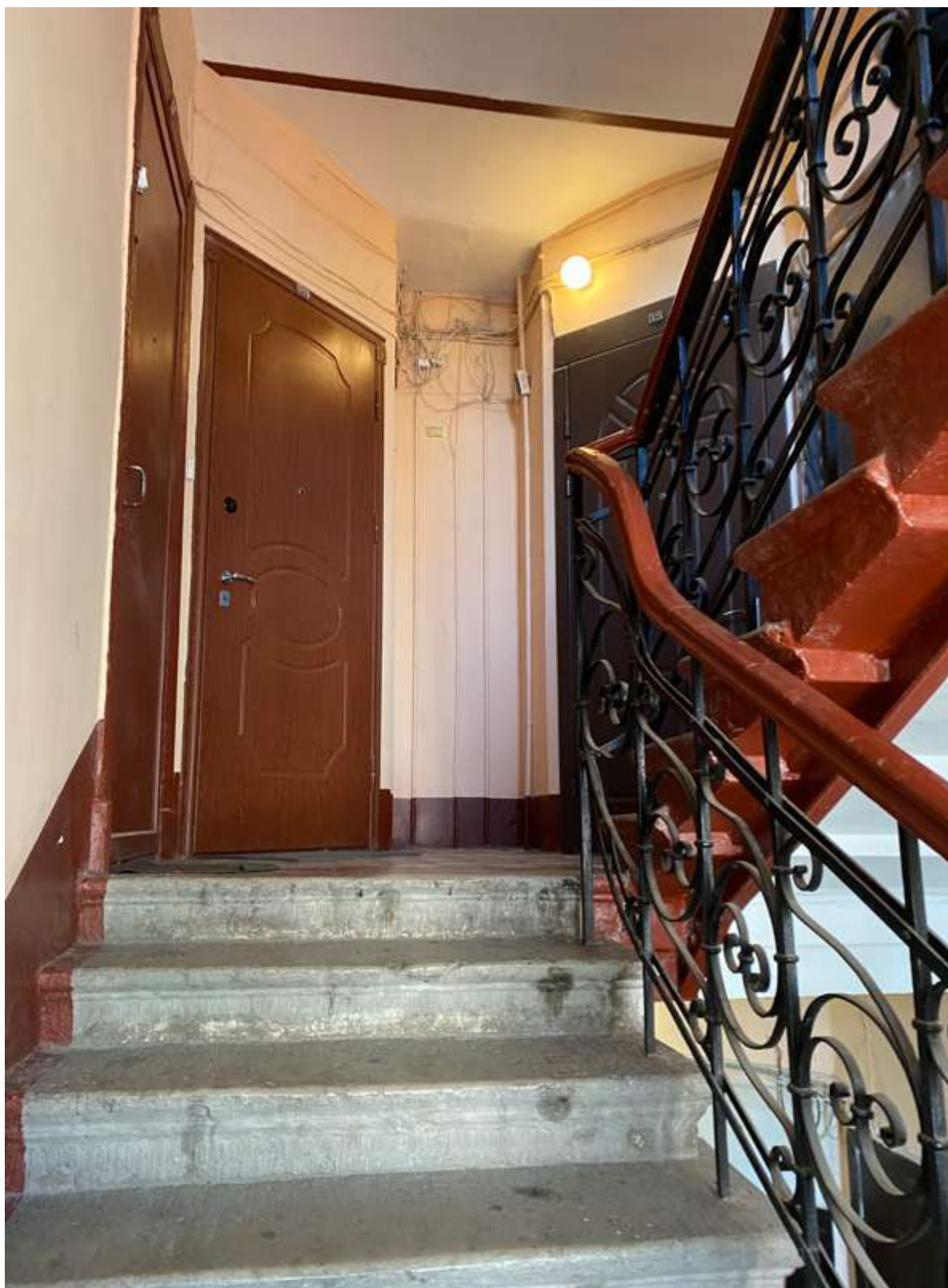
42. Фрагмент интерьера лестницы 1ЛК литеры А
