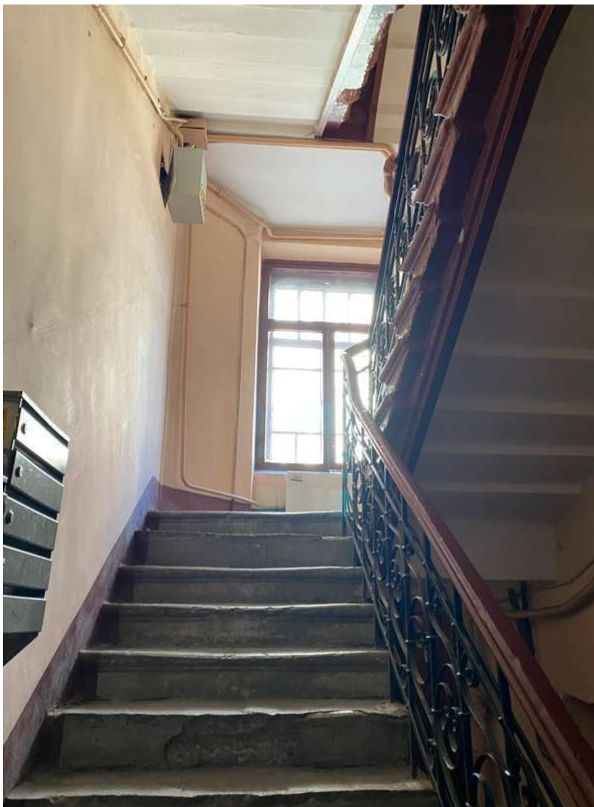
129. Фрагмент интерьера лестницы 1ЛК литеры Д
