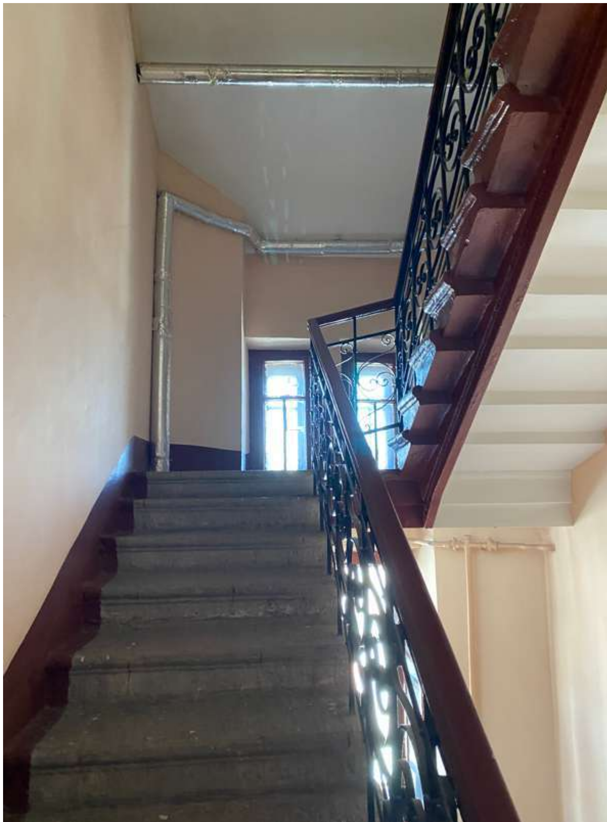
133. Фрагмент интерьера лестницы 1ЛК литеры Д
