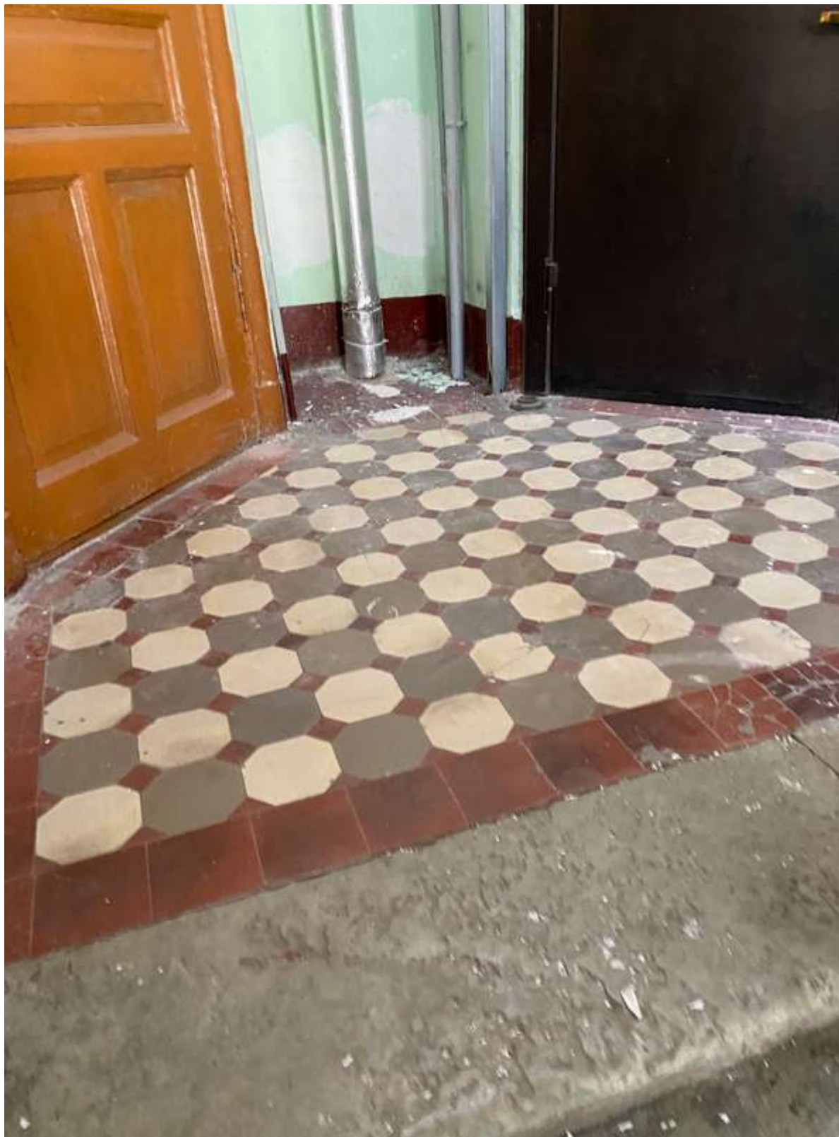
124. Фрагмент интерьера лестницы 2ЛК литеры Г
