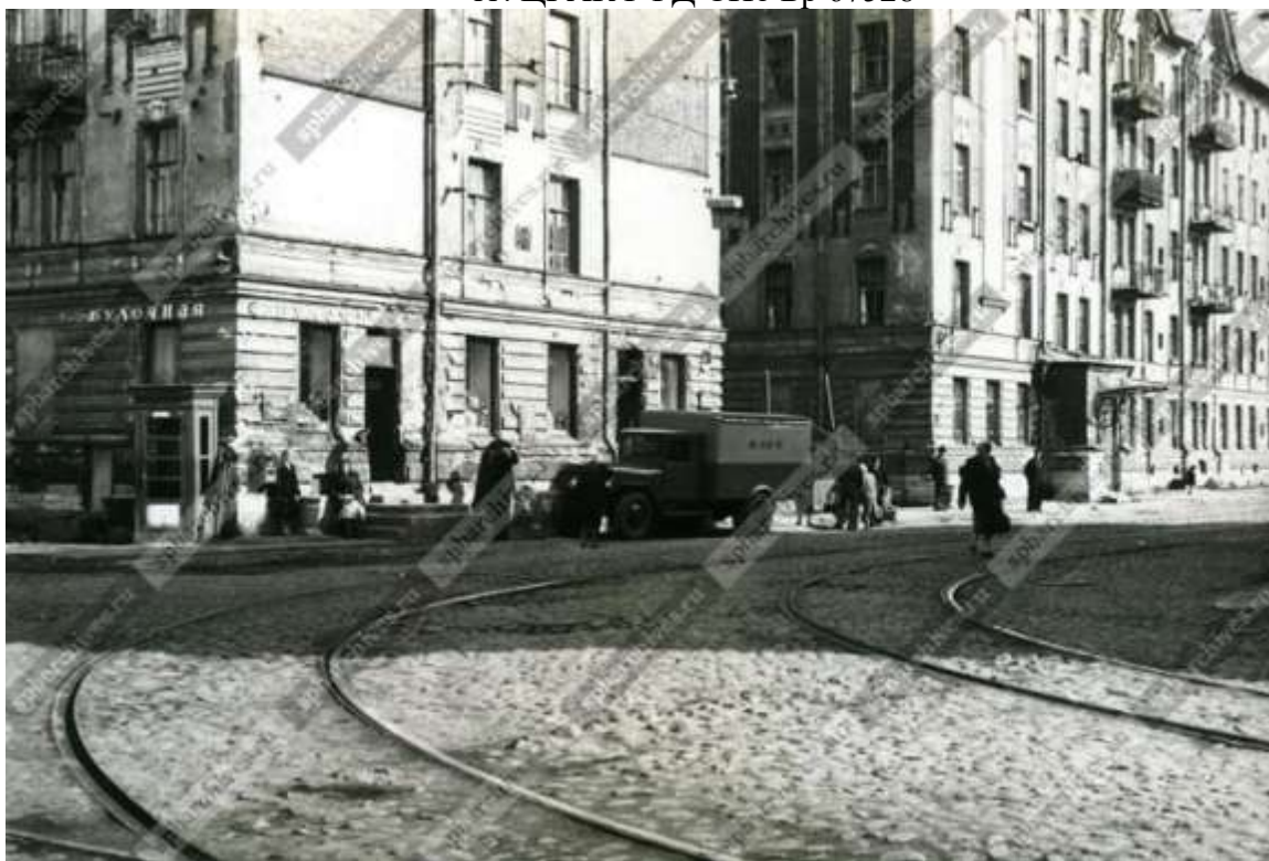
110. Фрагменты фасадов 2-ух жилых домов Жилого комплекса "Гаванский рабочий городок" (Гаванская ул., 47; Малый пр., 69, 71), гражд.инж.Н.В.Дмитриев при участии В.А.Федорова,1904-1906. 1955-1960 гг. ЦГАКФФД СПб Бр 67529
