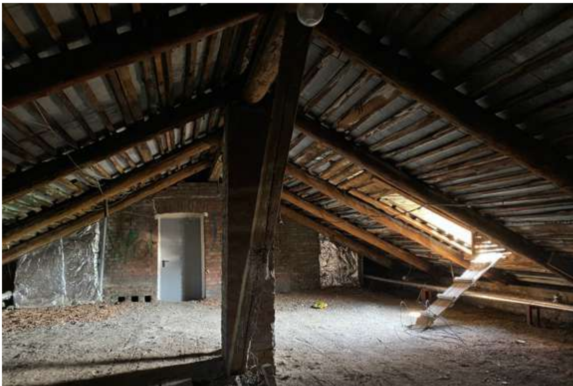
91. Фрагмент интерьера чердака литеры Б
