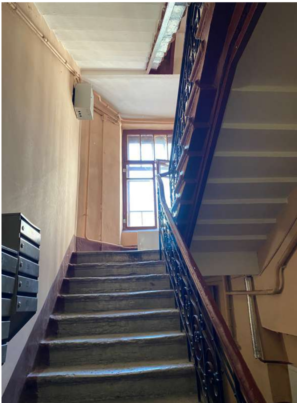
138. Фрагмент интерьера лестницы 2ЛК литеры Д
