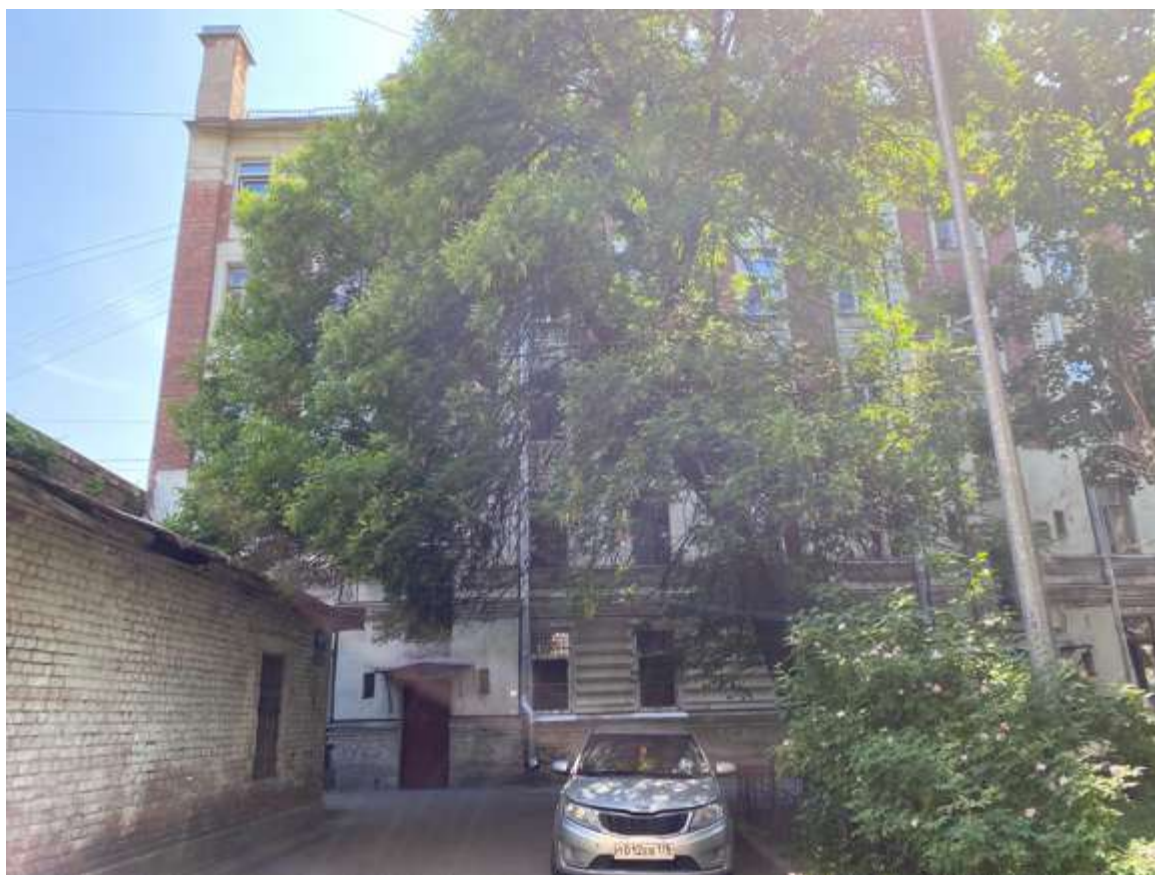
17. Фрагмент фасада литеры Б
