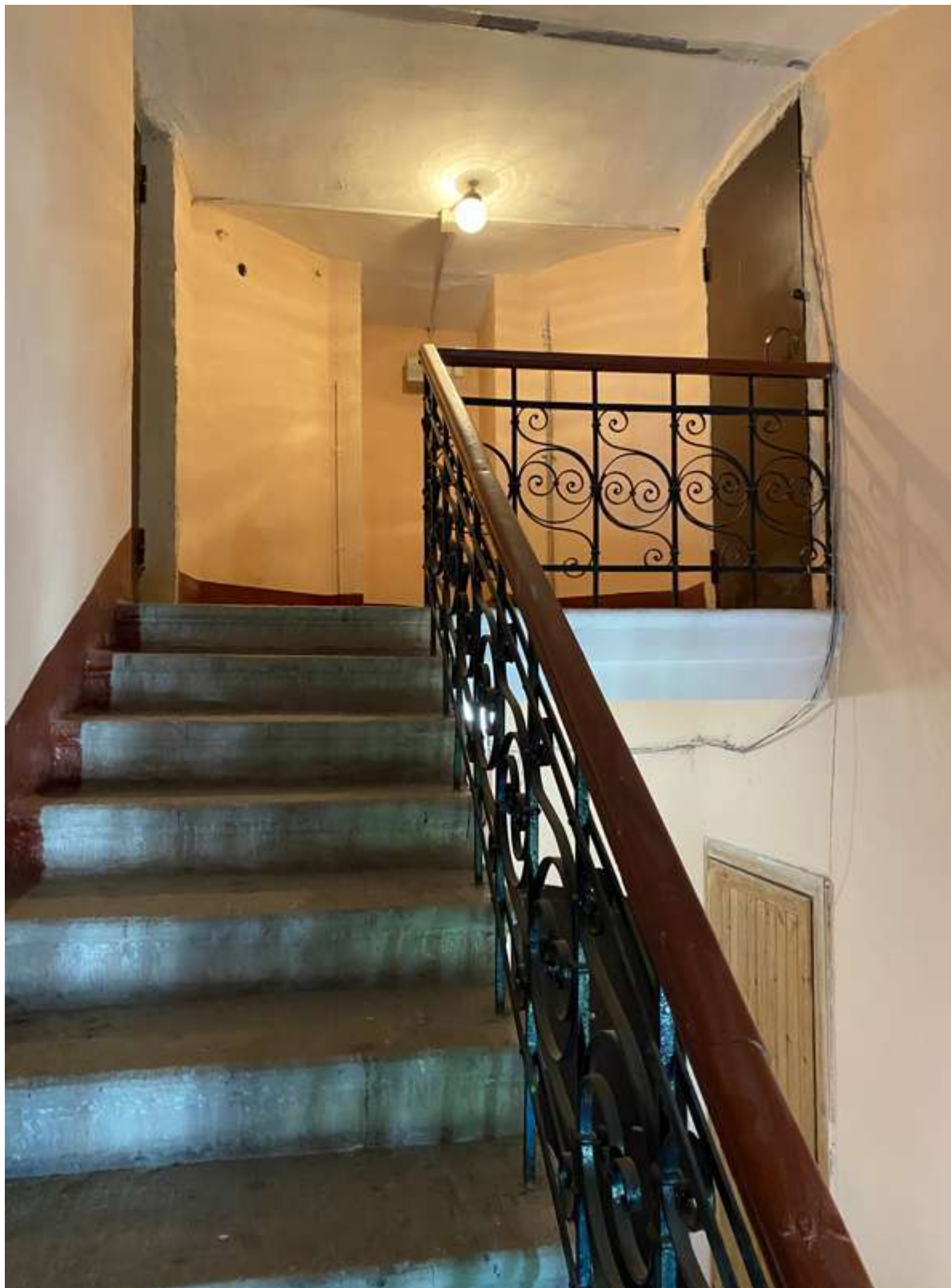
142. Фрагмент интерьера лестницы 2ЛК литеры Д
