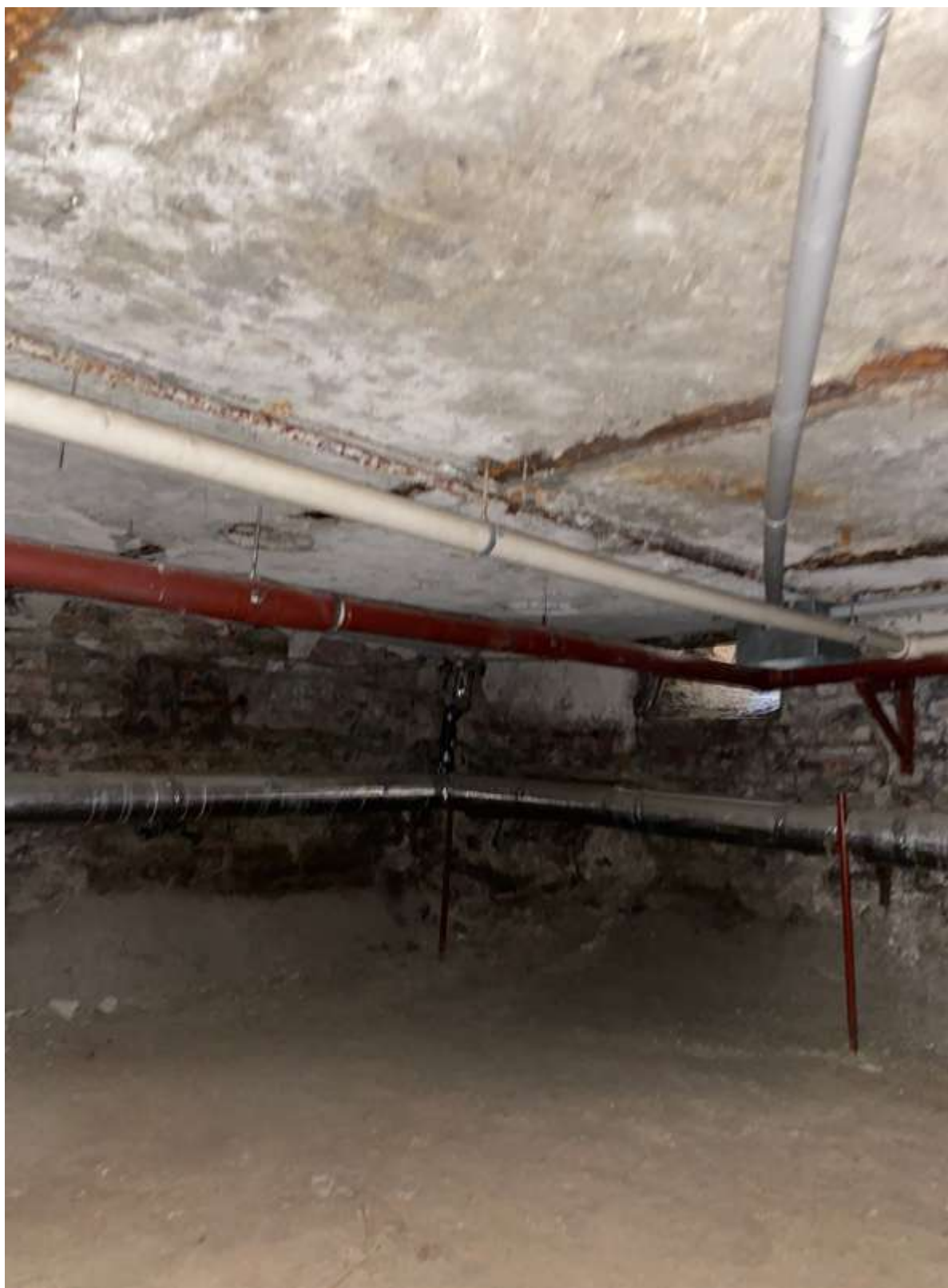
36. Фрагмент интерьера подвала литеры А
