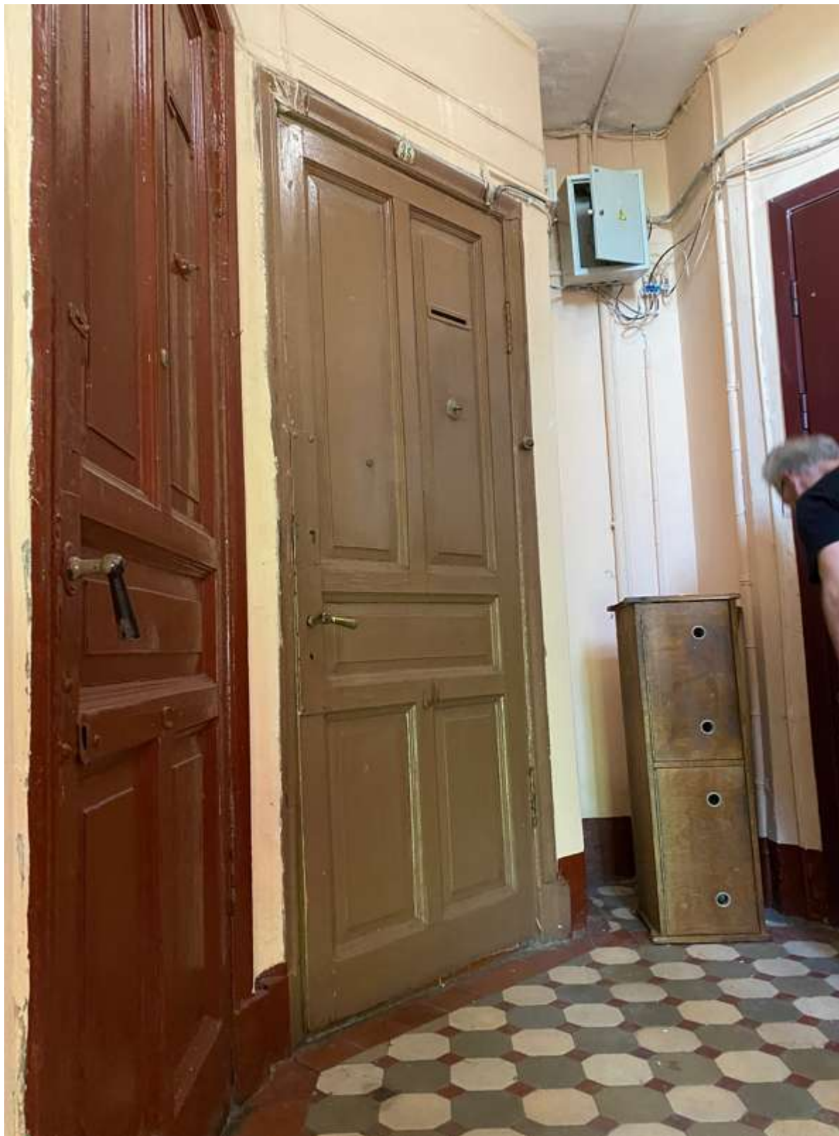
140. Фрагмент интерьера лестницы 2ЛК литеры Д
