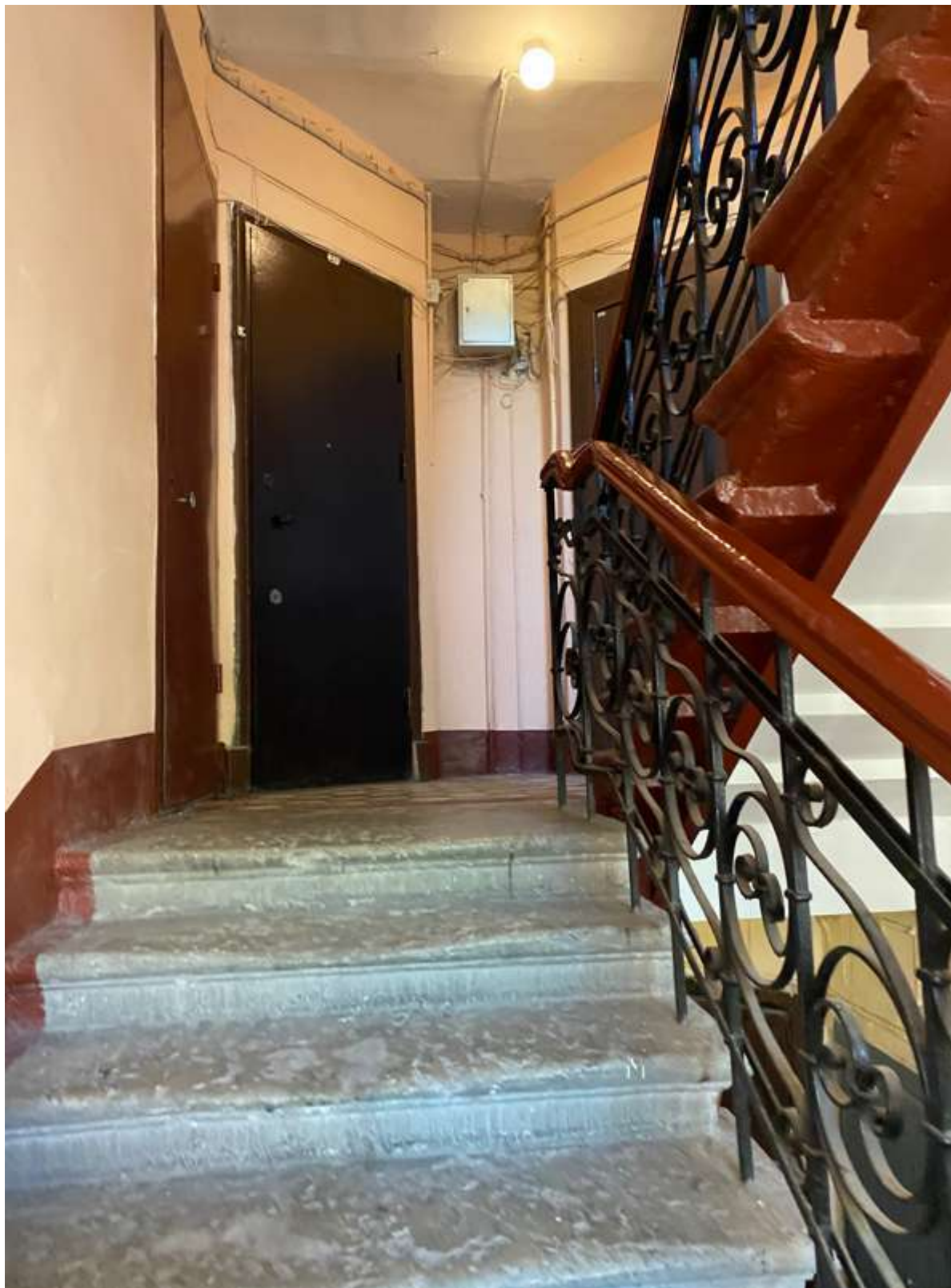
139. Фрагмент интерьера лестницы 2ЛК литеры Д
