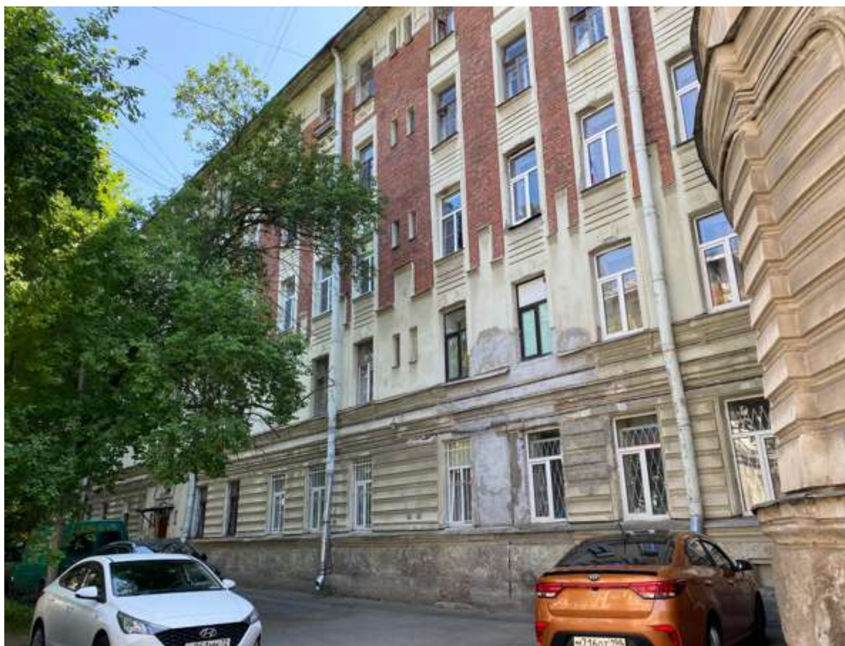
15. Фрагмент фасада литеры Б
