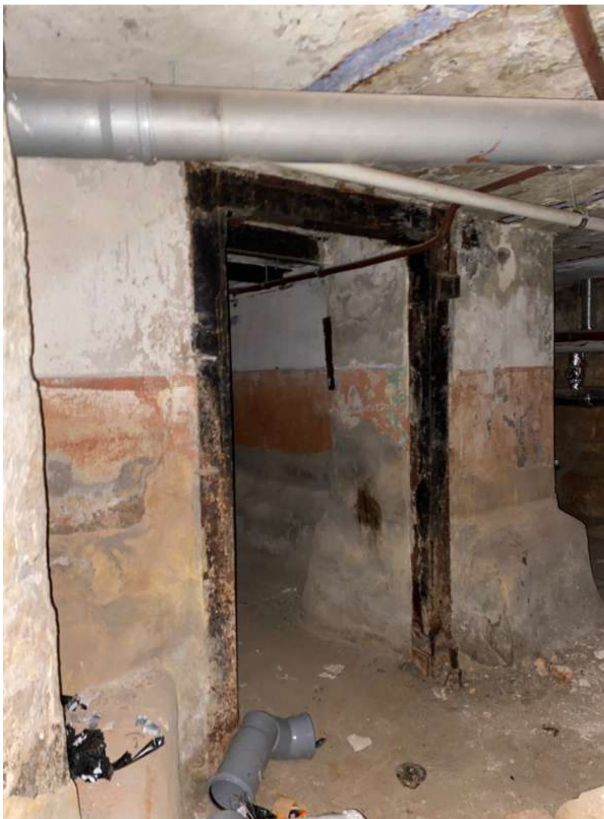
114. Фрагмент интерьера подвала литеры Г
