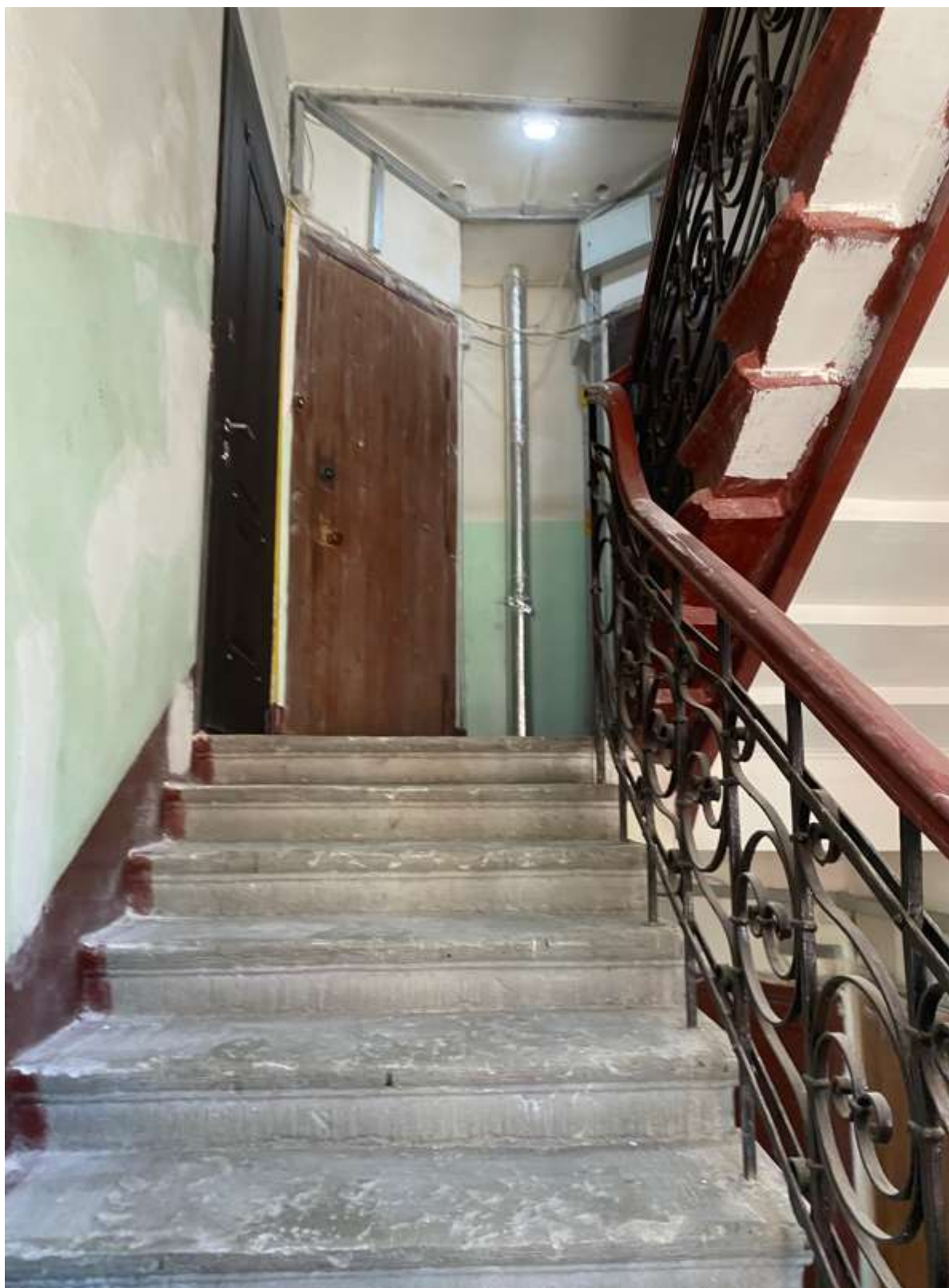
126. Фрагмент интерьера лестницы 2ЛК литеры Г
