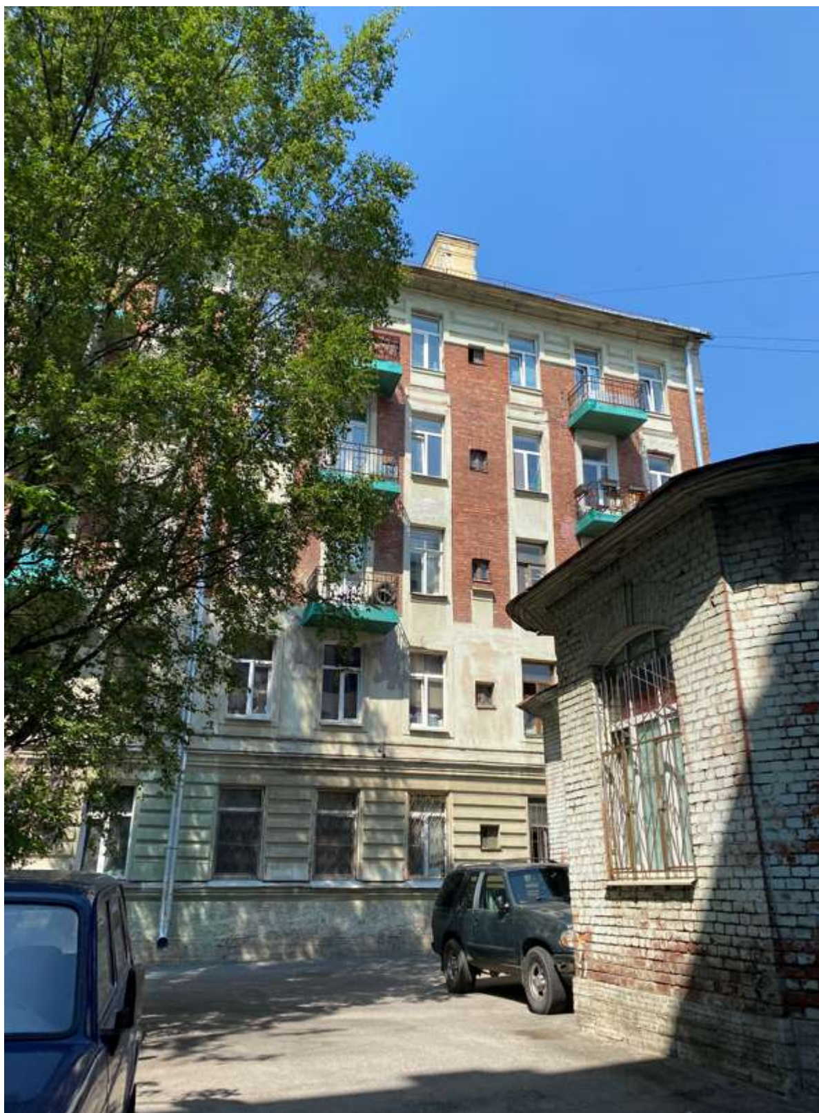
28. Фрагмент фасада литеры Б
