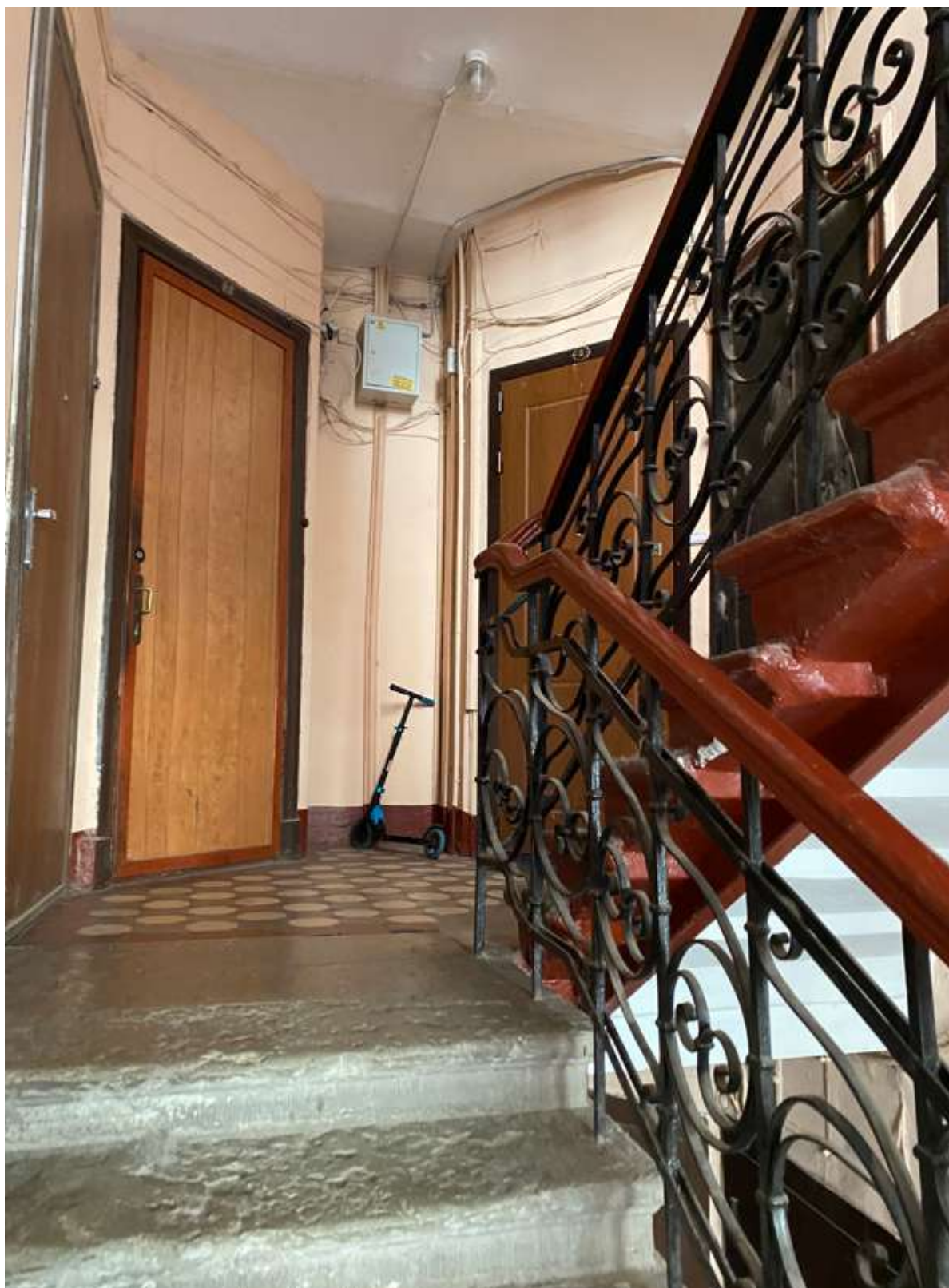
130. Фрагмент интерьера лестницы 1ЛК литеры Д
