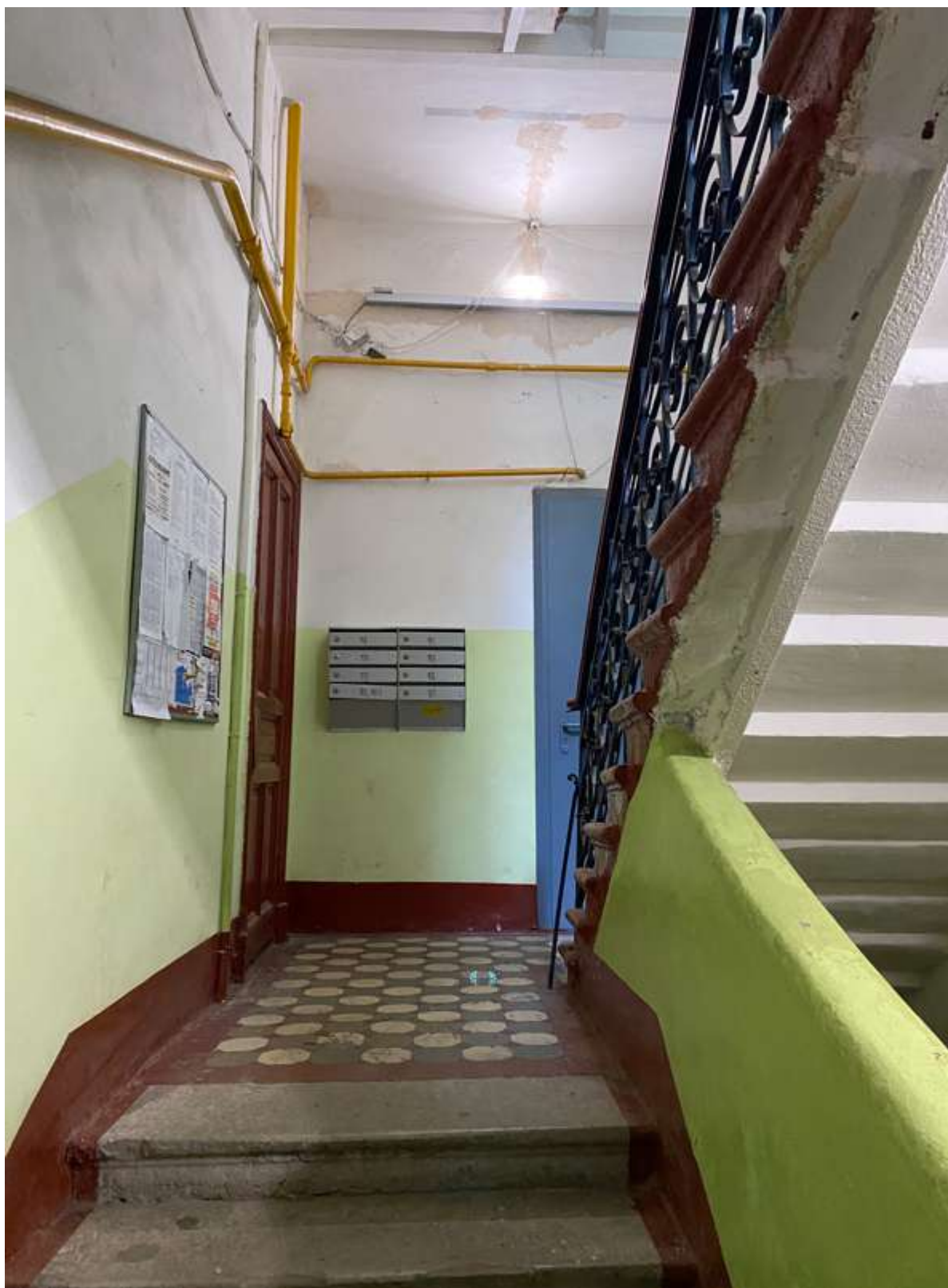
107. Фрагмент интерьера лестницы 2ЛК литеры В
