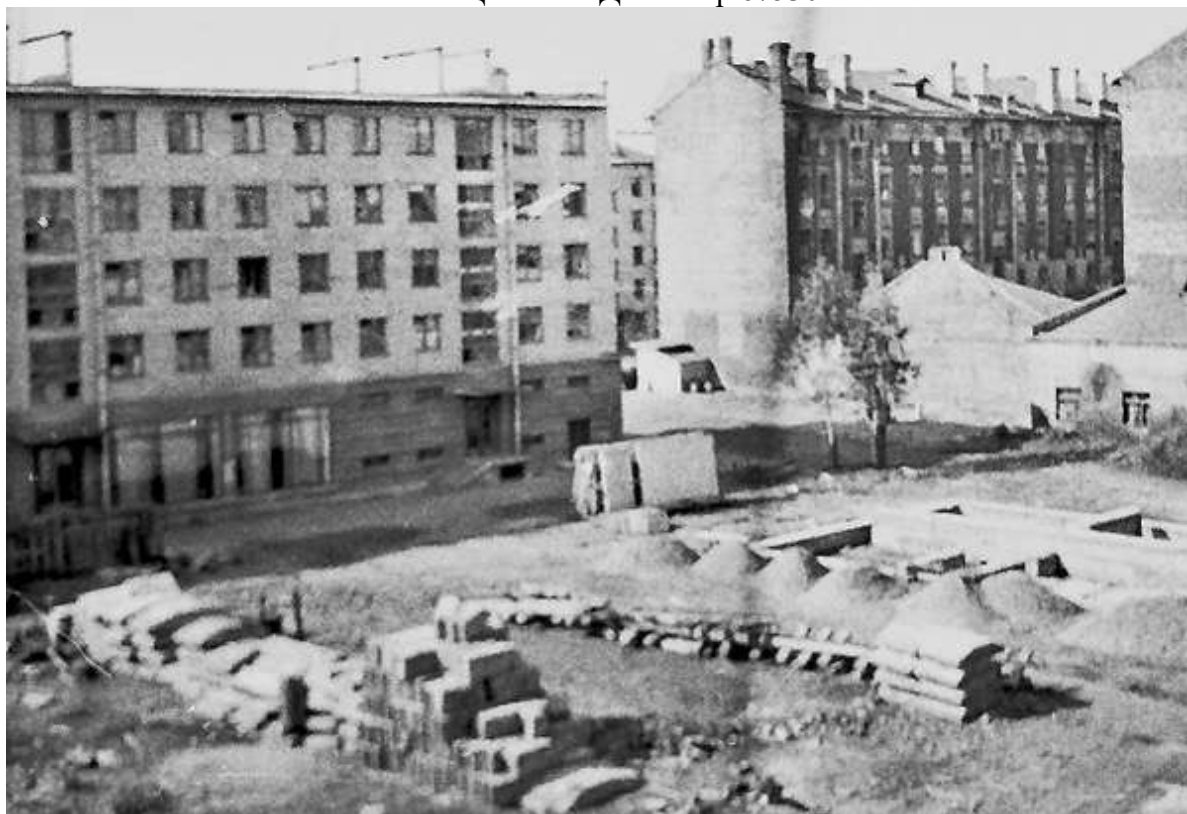
112. Строительство дома 67 к. 2 по Малому пр. В.О. 1962-1963 гг. . [Электронный ресурс] URL: https://pastvu.com/p/684400
