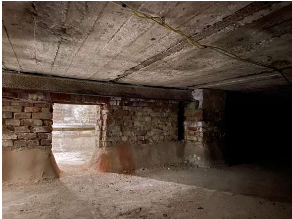
67. Фрагмент интерьера подвала литеры А
