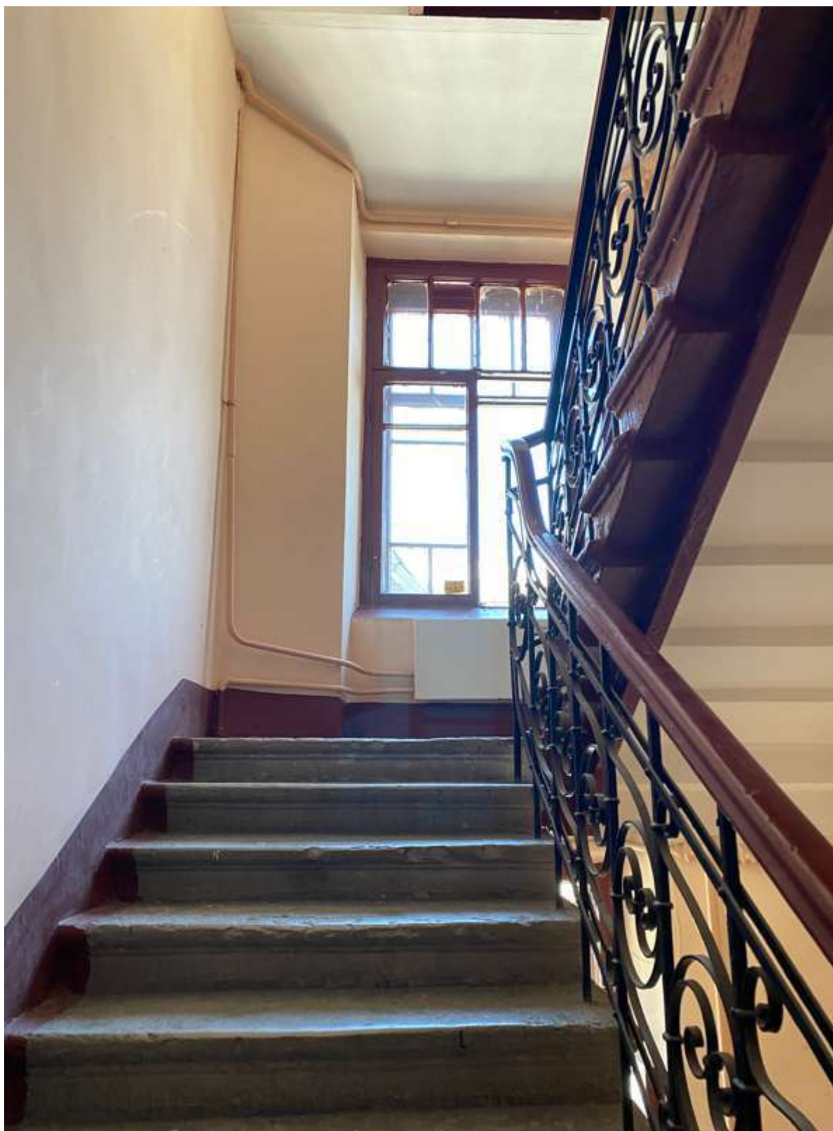
132. Фрагмент интерьера лестницы 1ЛК литеры Д
