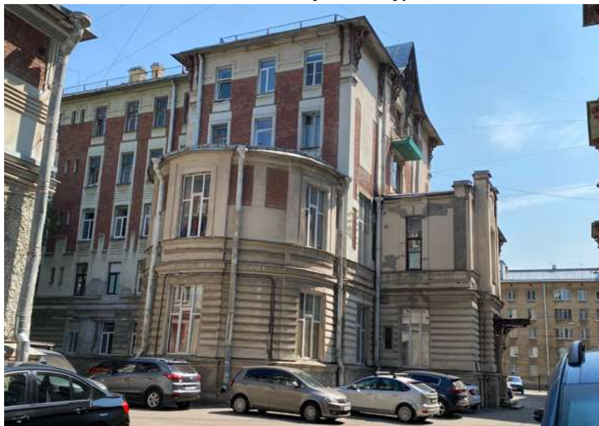
14. Вид на литеру Б
