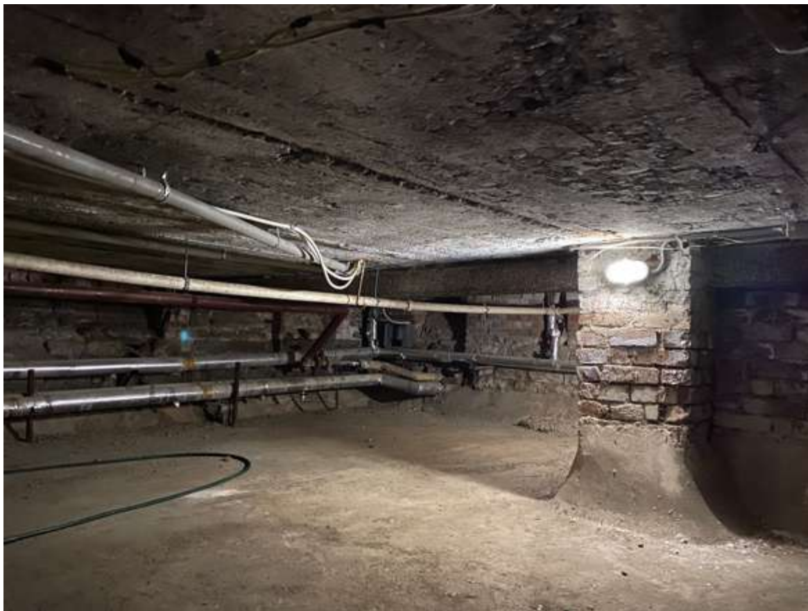
66. Фрагмент интерьера подвала литеры А
