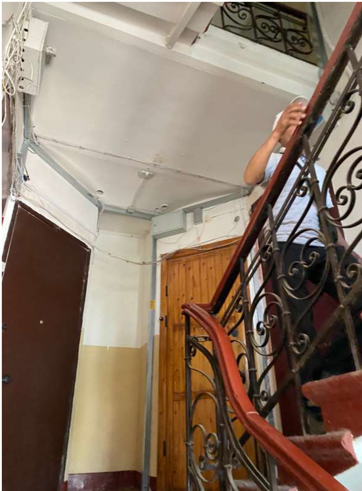
119. Фрагмент интерьера лестницы 1ЛК литеры Г
