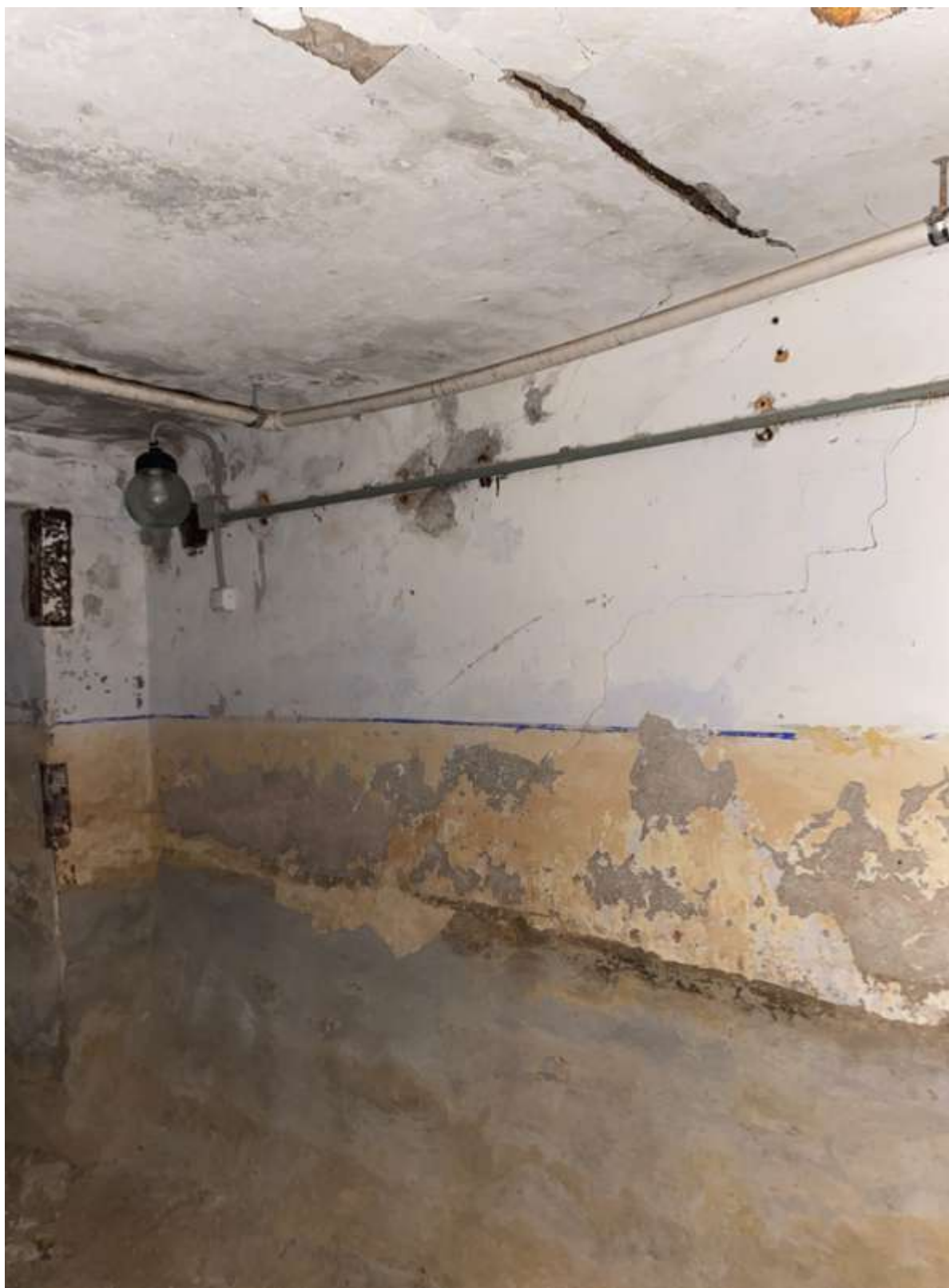
137. Фрагмент интерьера подвала литеры Д
