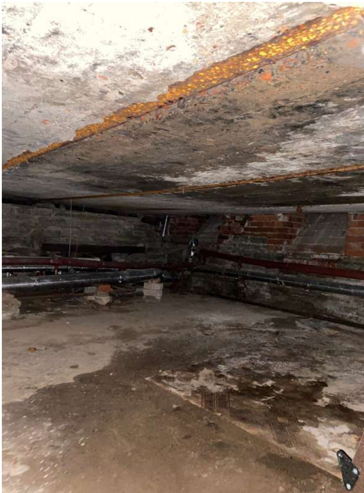
76. Фрагмент интерьера подвала литеры Б
