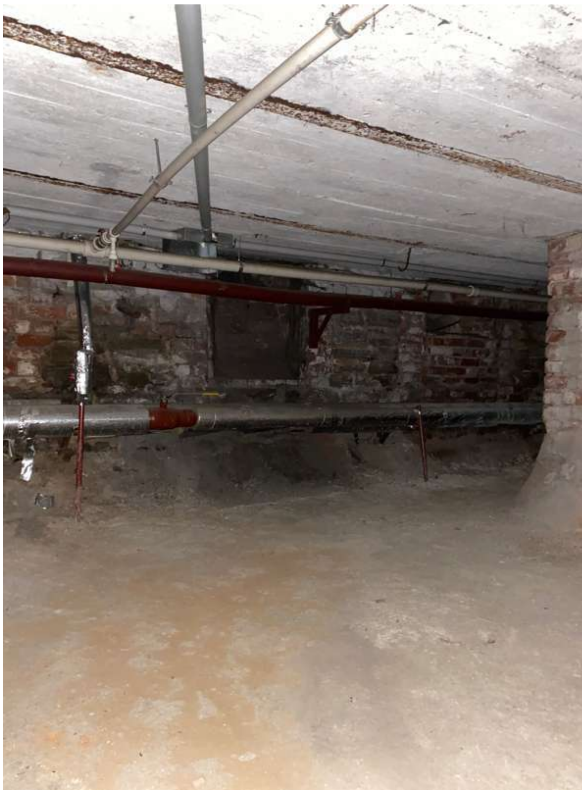
48. Фрагмент интерьера подвала литеры А
