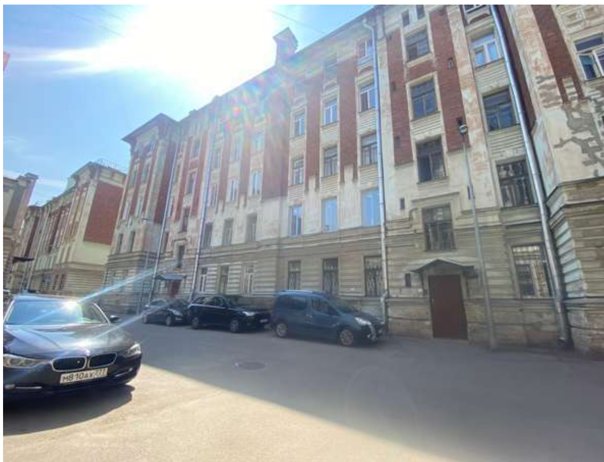
13. Вид со двора на литеру Д
