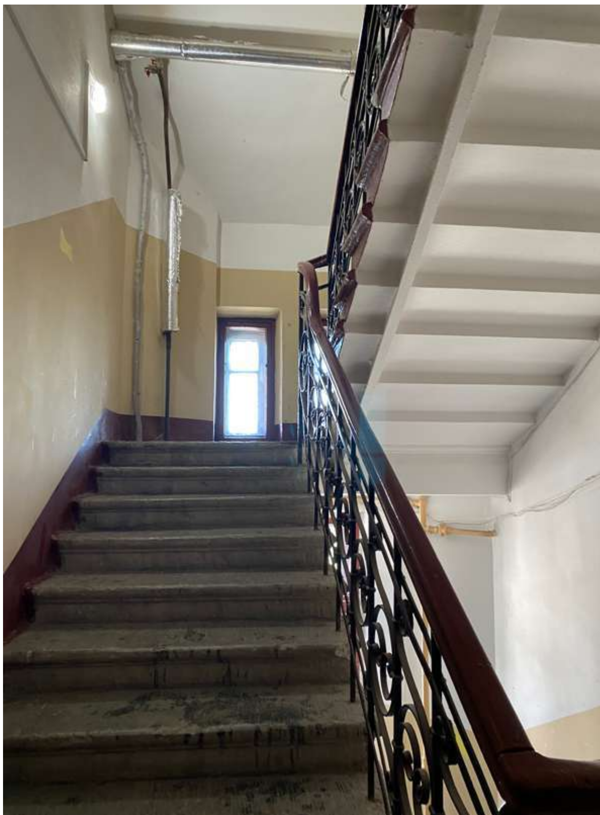
120. Фрагмент интерьера лестницы 1ЛК литеры Г
