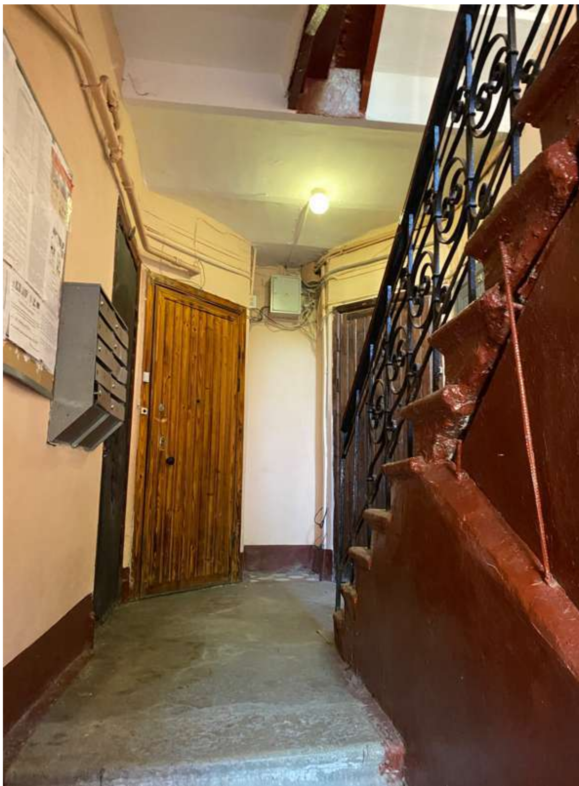
136. Фрагмент интерьера лестницы 2ЛК литеры Д
