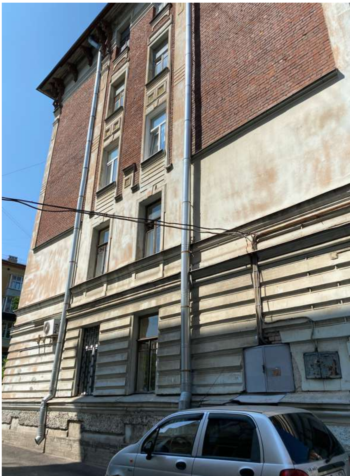
22. Торцевой фасад литеры Д
