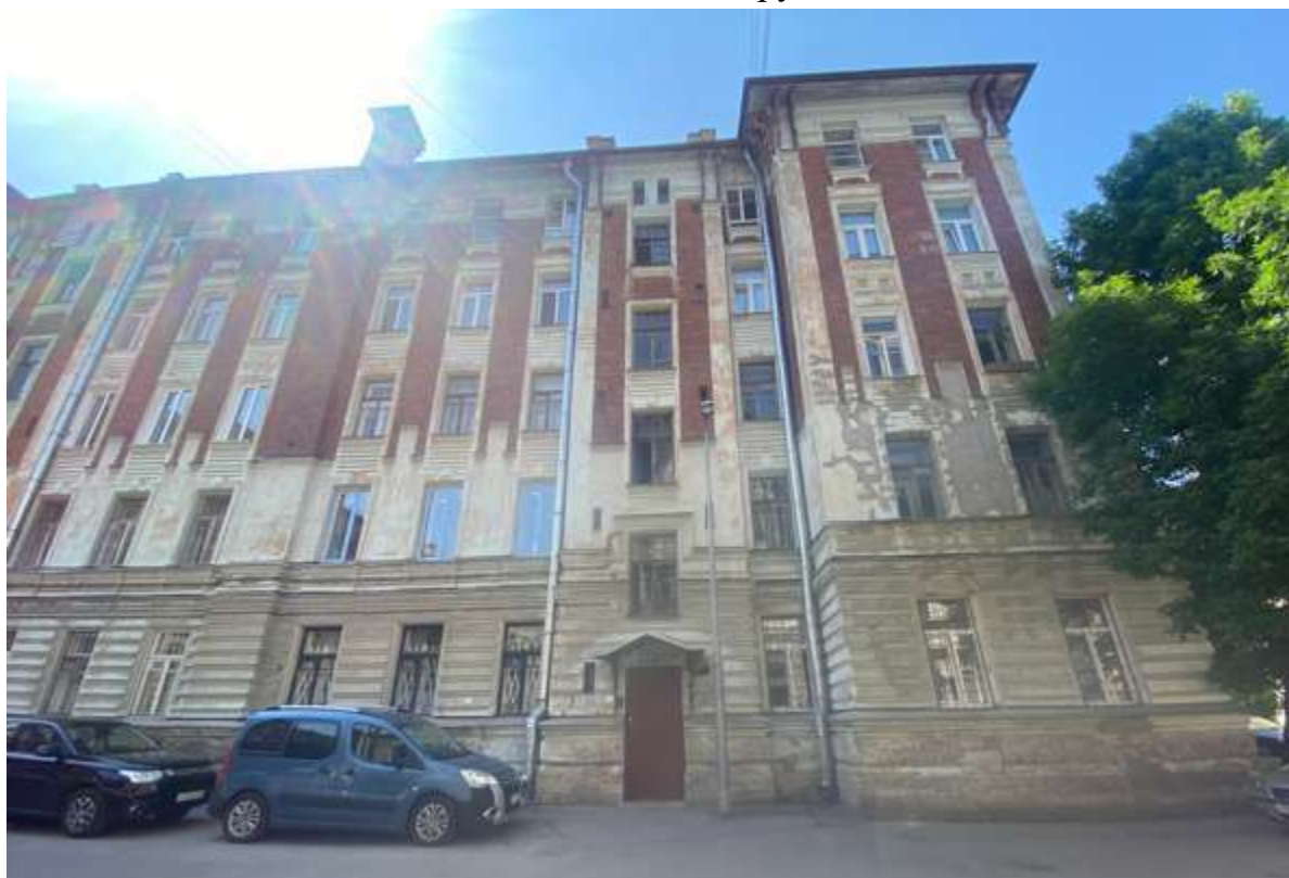
12. Вид со двора на литеру Д
