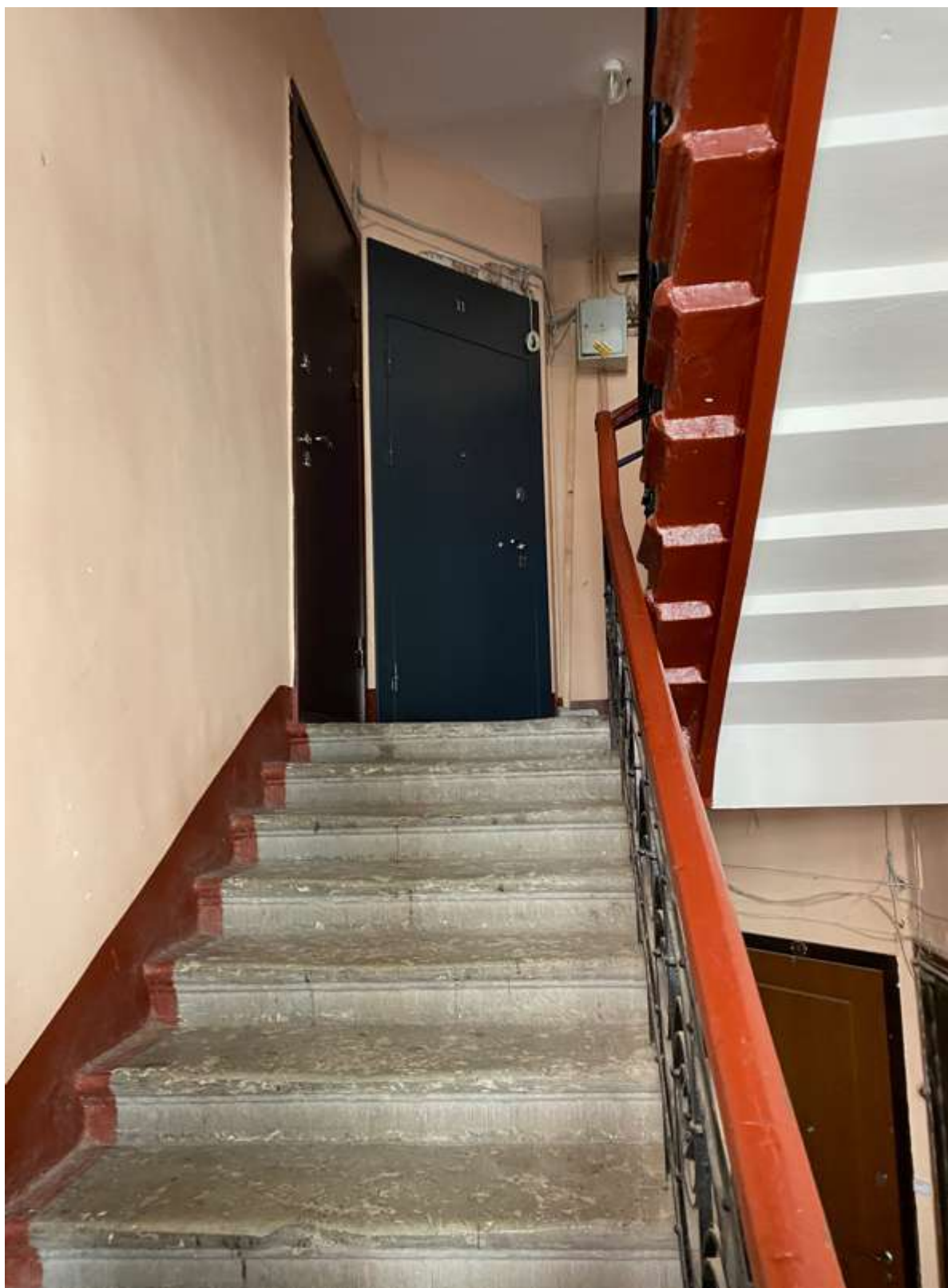
131. Фрагмент интерьера лестницы 1ЛК литеры Д
