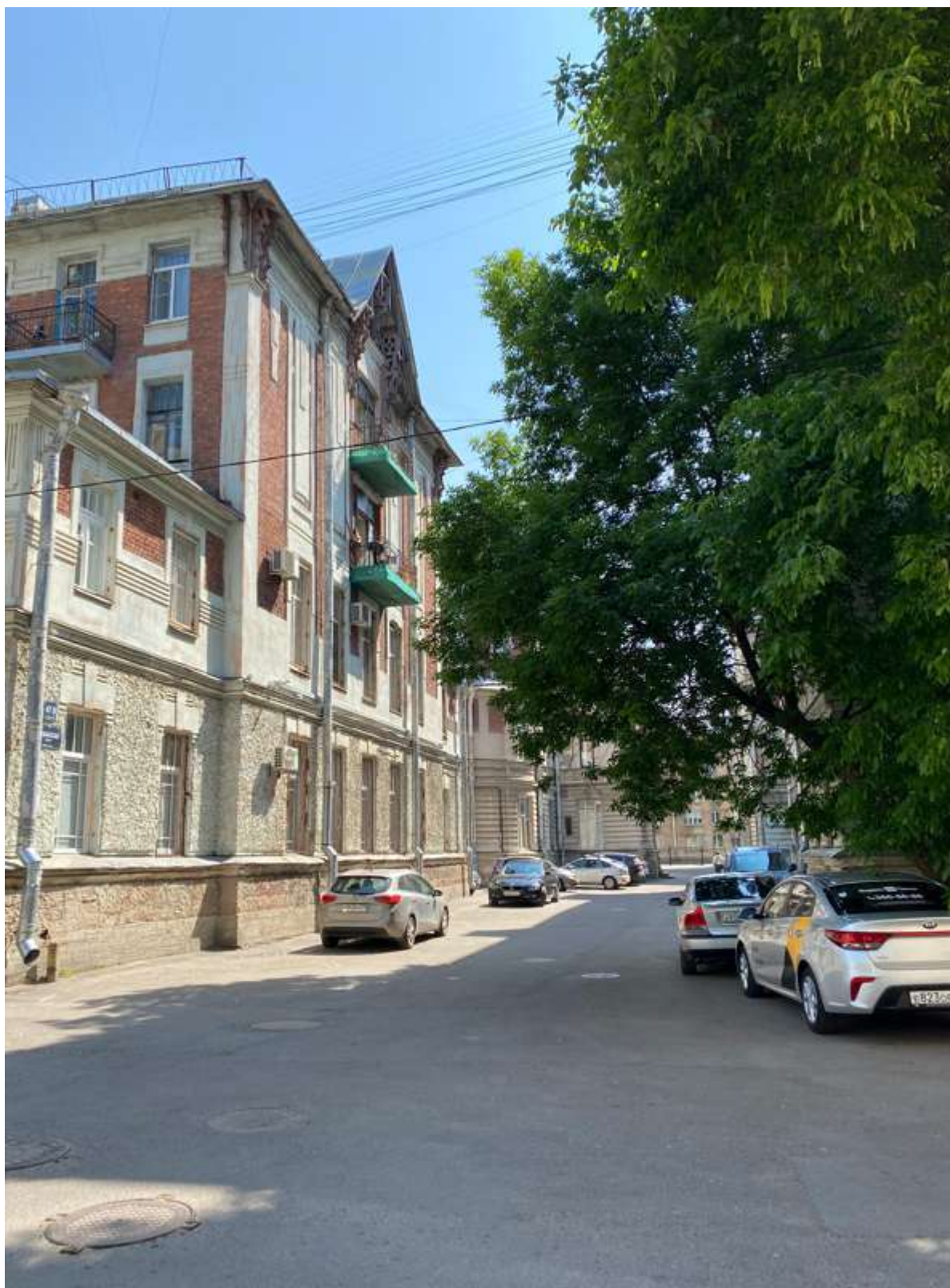
10. Вид на литеру В
