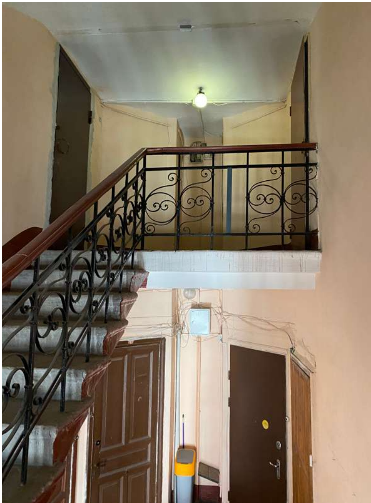
134. Фрагмент интерьера лестницы 1ЛК литеры Д
