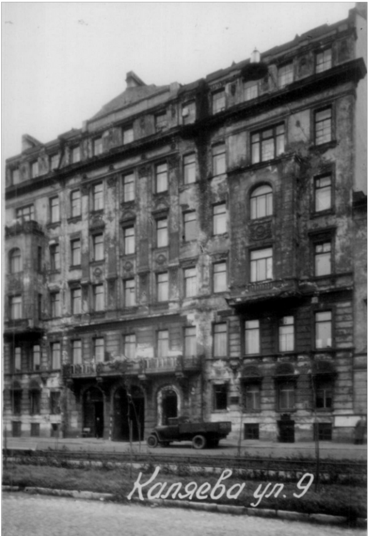
Илл. 23. Фасад дома №9 на улице Каляева [до ремонта], 1960 г. ЦГАКФФД СПб Гр 75162.
