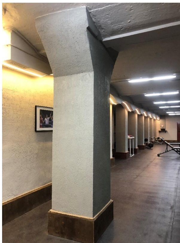
Фото 4. Вид на подвальное помещение. Автор фото: Штиглиц М.С. Дата: 17.04.2023.
