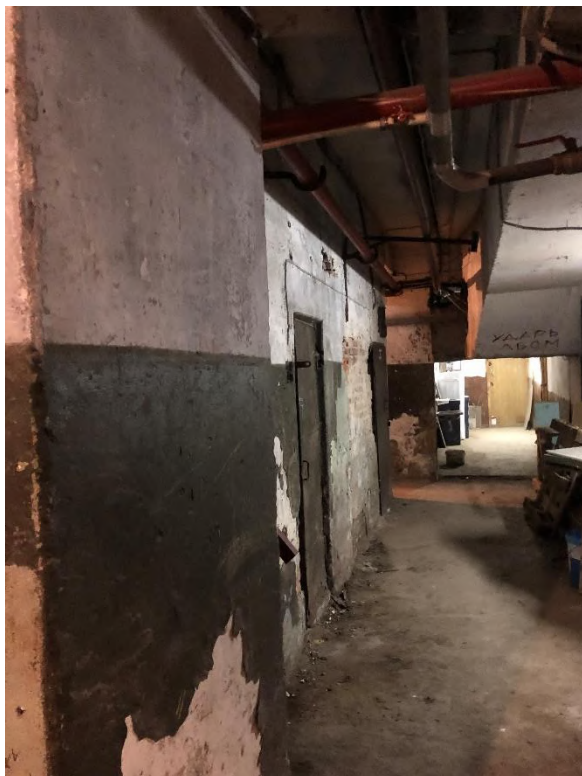
Фото 1. Вид на подвальное помещение. Автор фото: Штиглиц М.С. Дата: 17.04.2023.
