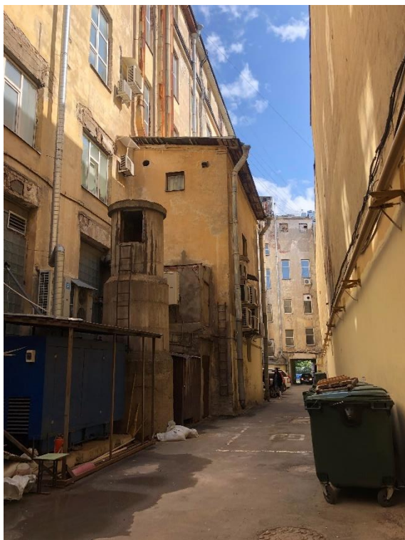
Фото 10. Дворовые фасады. Автор фото: Штиглиц М.С. Дата: 17.04.2023.
