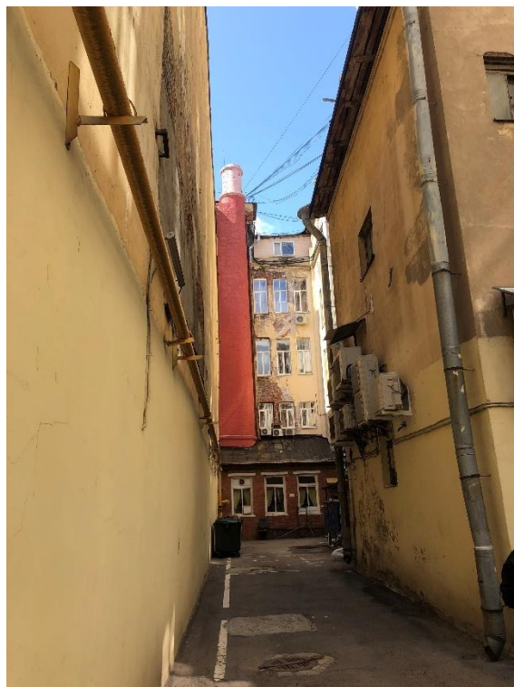
Фото 11. Дворовые фасады. Автор фото: Штиглиц М.С. Дата: 17.04.2023.
