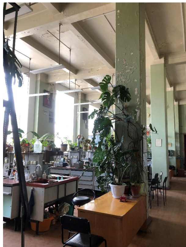
Фото 14. Первый этаж. Помещение 5Н (43). Автор фото: Штиглиц М.С. Дата: 17.04.2023.
