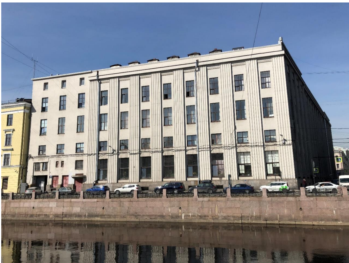
Фото 8. Вид на лицевой фасад объекта культурного наследия по набережной реки Мойки. Автор фото: Штиглиц М.С. Дата: 17.04.2023.
