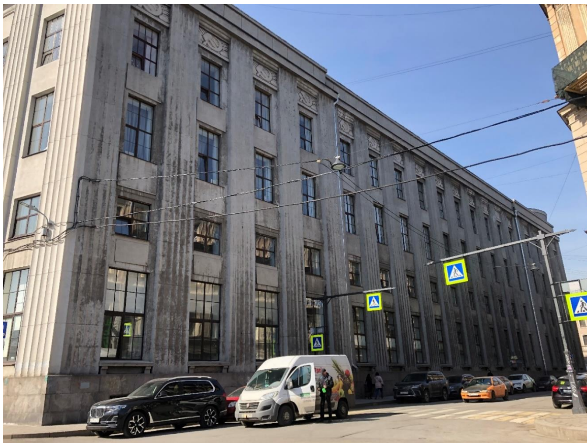
Фото 6. Вид на лицевой фасад объекта культурного наследия по Кирпичному переулку. Автор фото: Штиглиц М.С. Дата: 17.04.2023.
