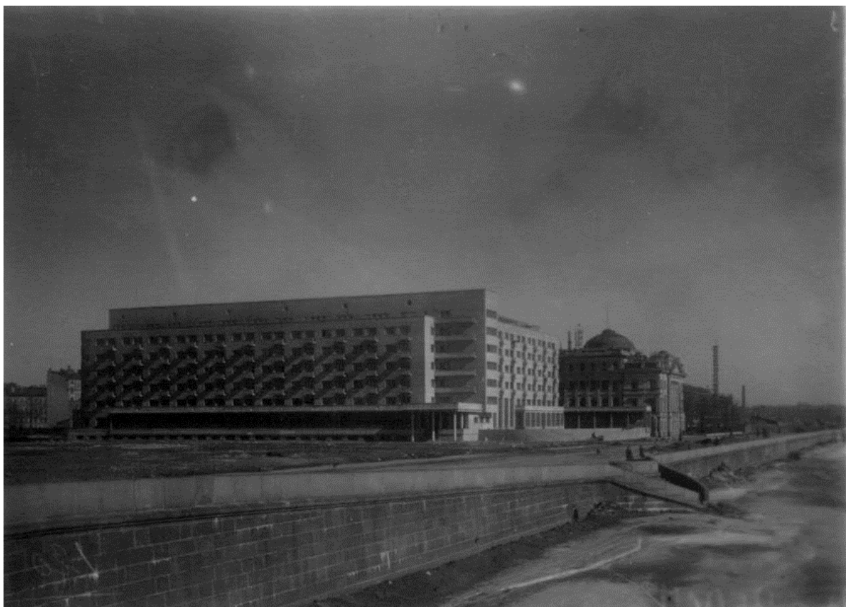
27. Общий вид фасада жилого дома Общества бывших политкаторжан (1929–1933 гг. – архитекторы Г.А. Симонов, П.В. Абросимов, А.Ф. Хряков). 1934 г. ЦГАКФФД СПб. Вр 26267.
