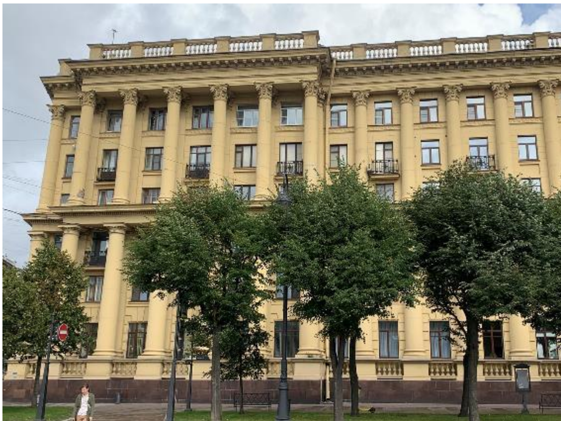
48. Лицевой фасад жилого дома. Вид с Троицкой площади. Фото 17.06.2023
