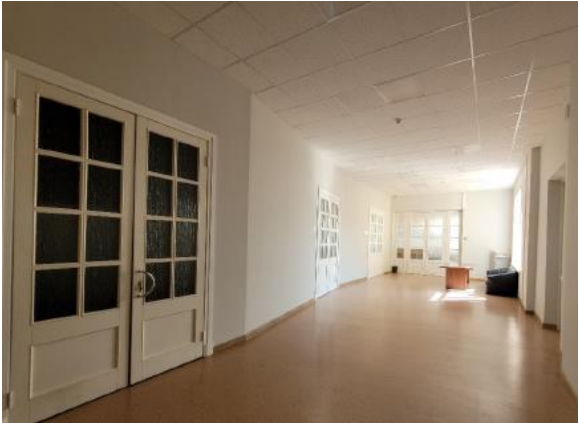
46. Коридор 7-го этажа здания института «Ленпроект». Фото 17.04.2023
