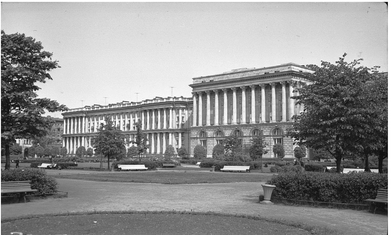
38. Вид от площади Революции на комплекс зданий, жилой дом и здание Ленпроекта с колонным портиком и рустованным фасадом (архитекторы О.И. Гурьев, Я.Н. Лукин, А.П. Щербенок, 1955–1956 гг.). 1957 г. ЦГАКФФД СПб. Бр 75636.
