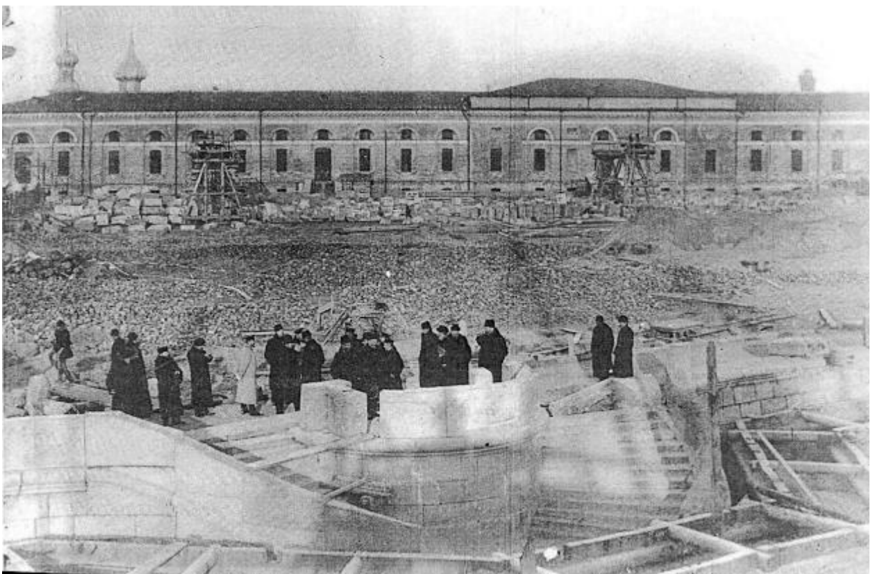
20. Окончание строительства спуска к воде на Петровской набережной. 1903 г. https://pastvu.com
