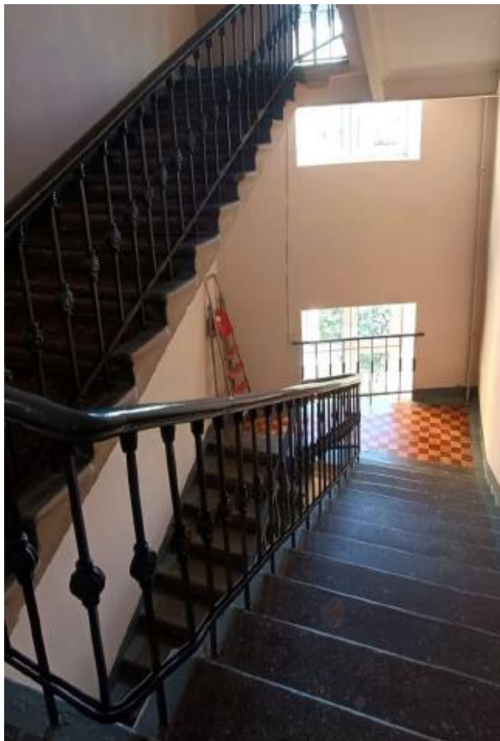
41. Вспомогательная лестница здания института «Ленпроект». Марш 7-го этажа. Фото 17.04.2023
