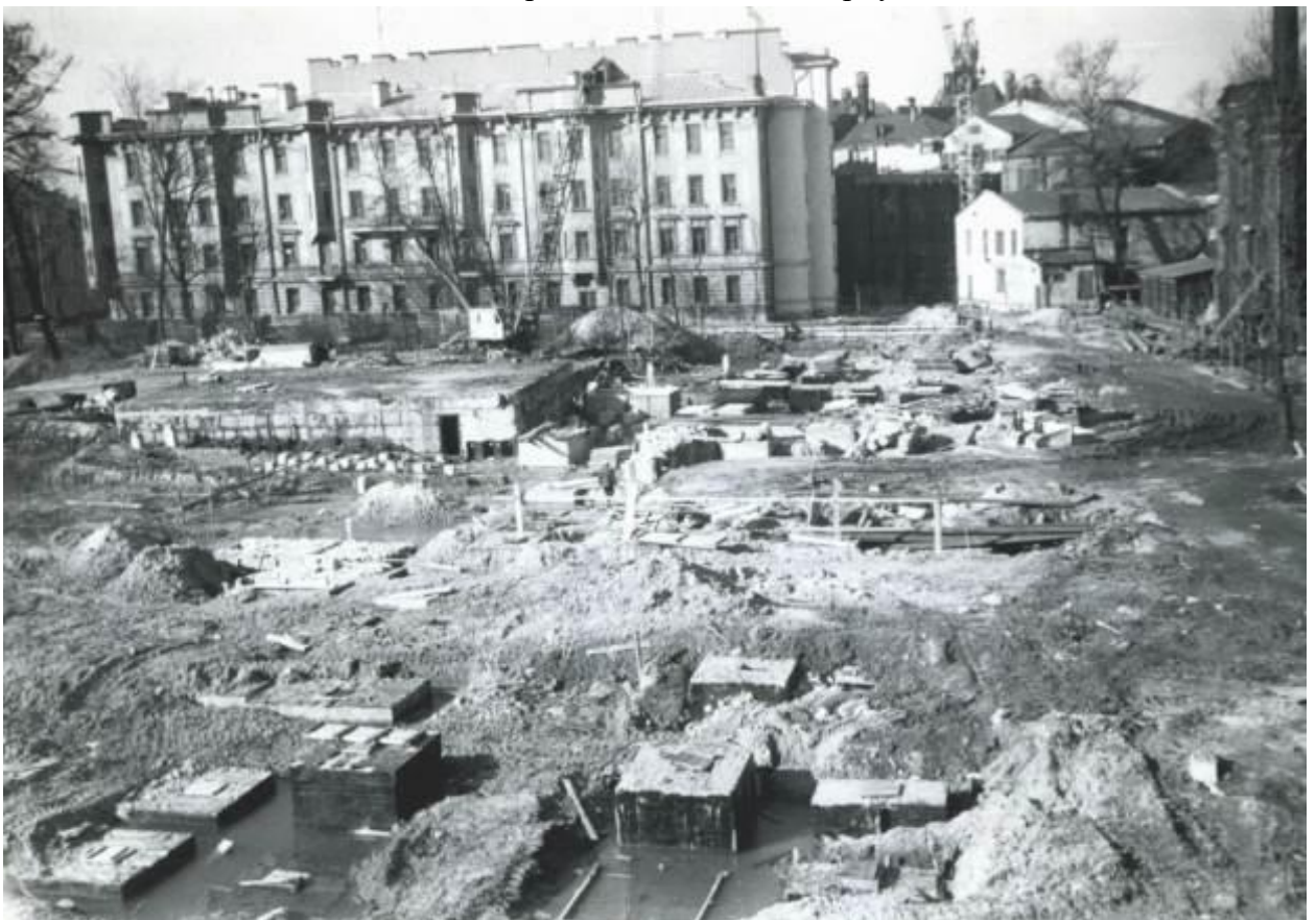
57. Фото около 1970 г. Начало строительства пятого корпуса
