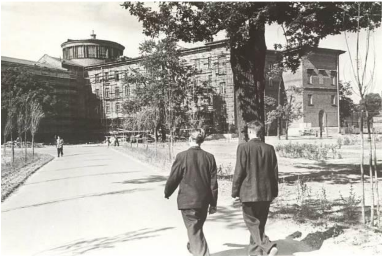
51. Фото 1956. Территория до строительства пятого корпуса
