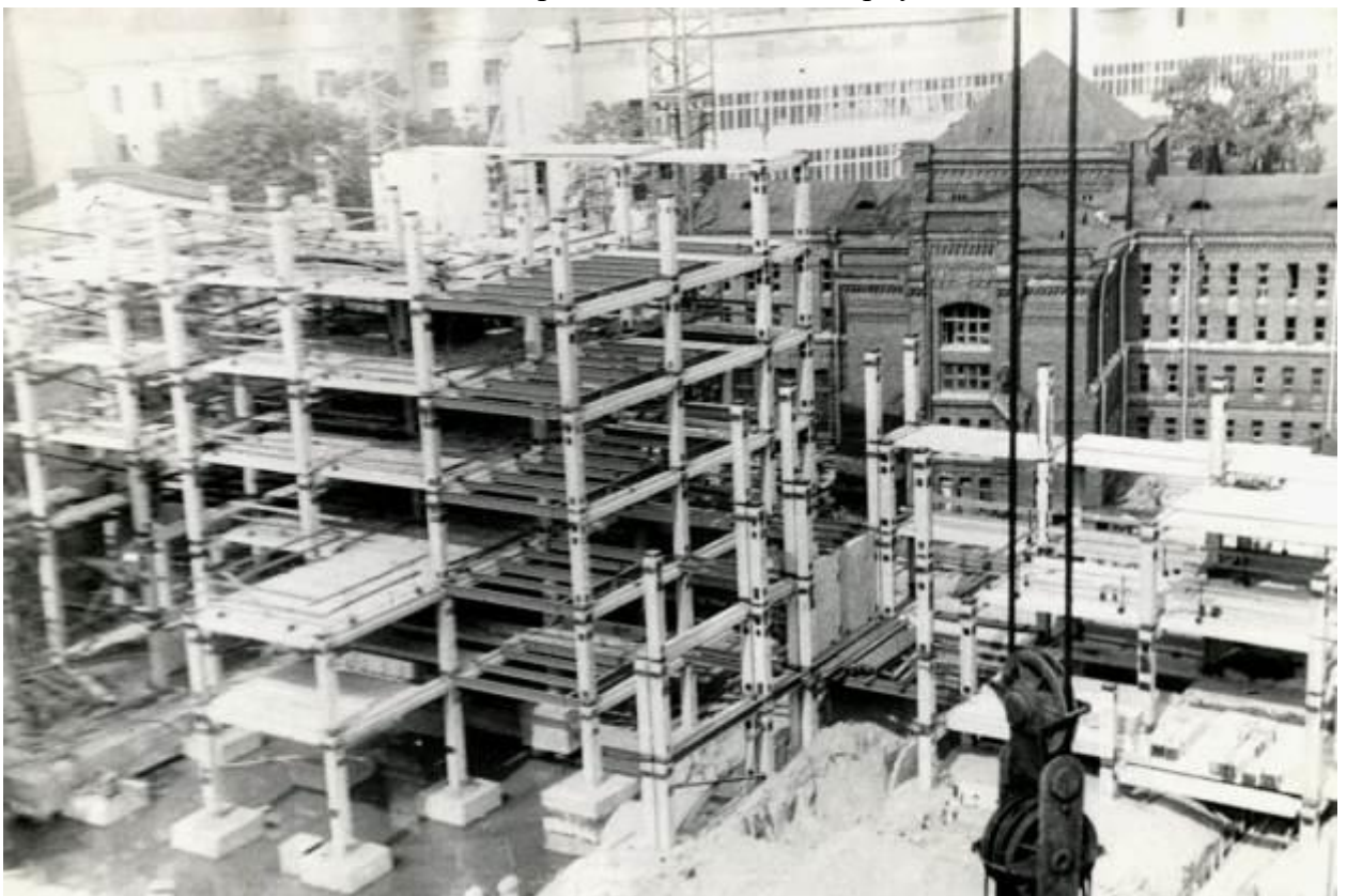
59. Фото 1970-е гг. Строительство пятого корпуса
