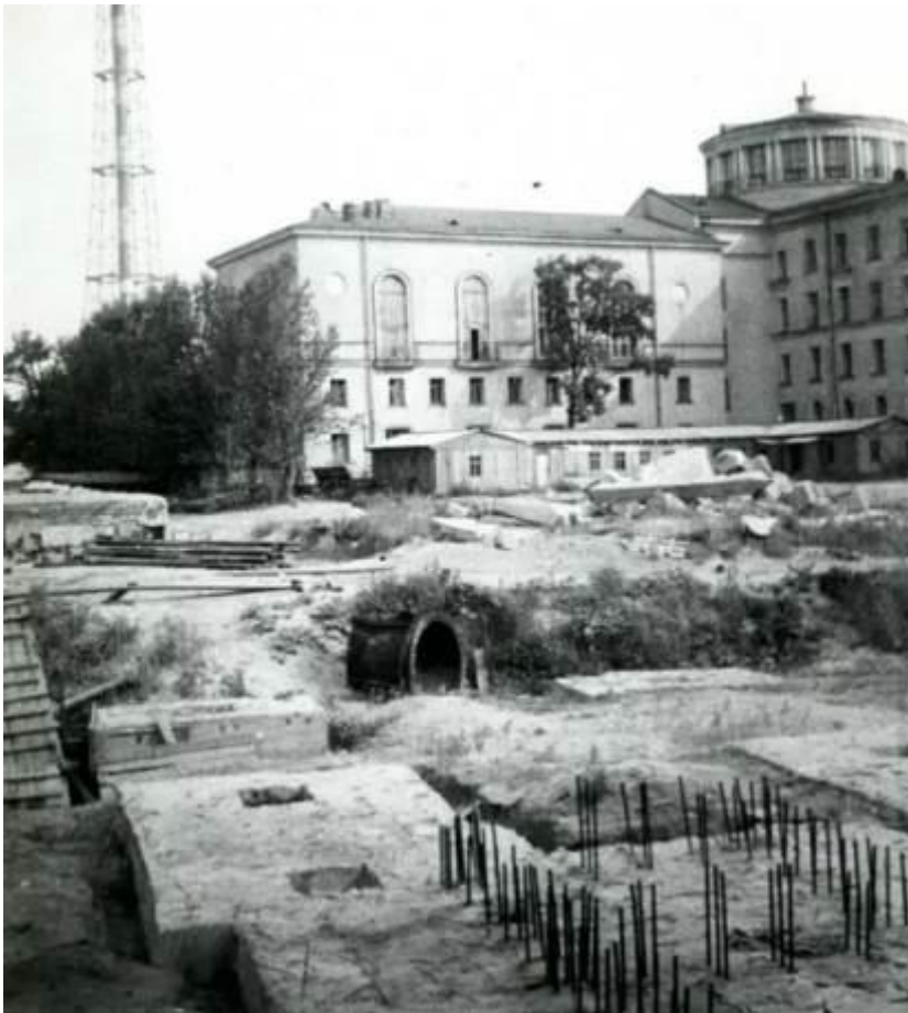
55. Фото около 1970 г. Начало строительства пятого корпуса
