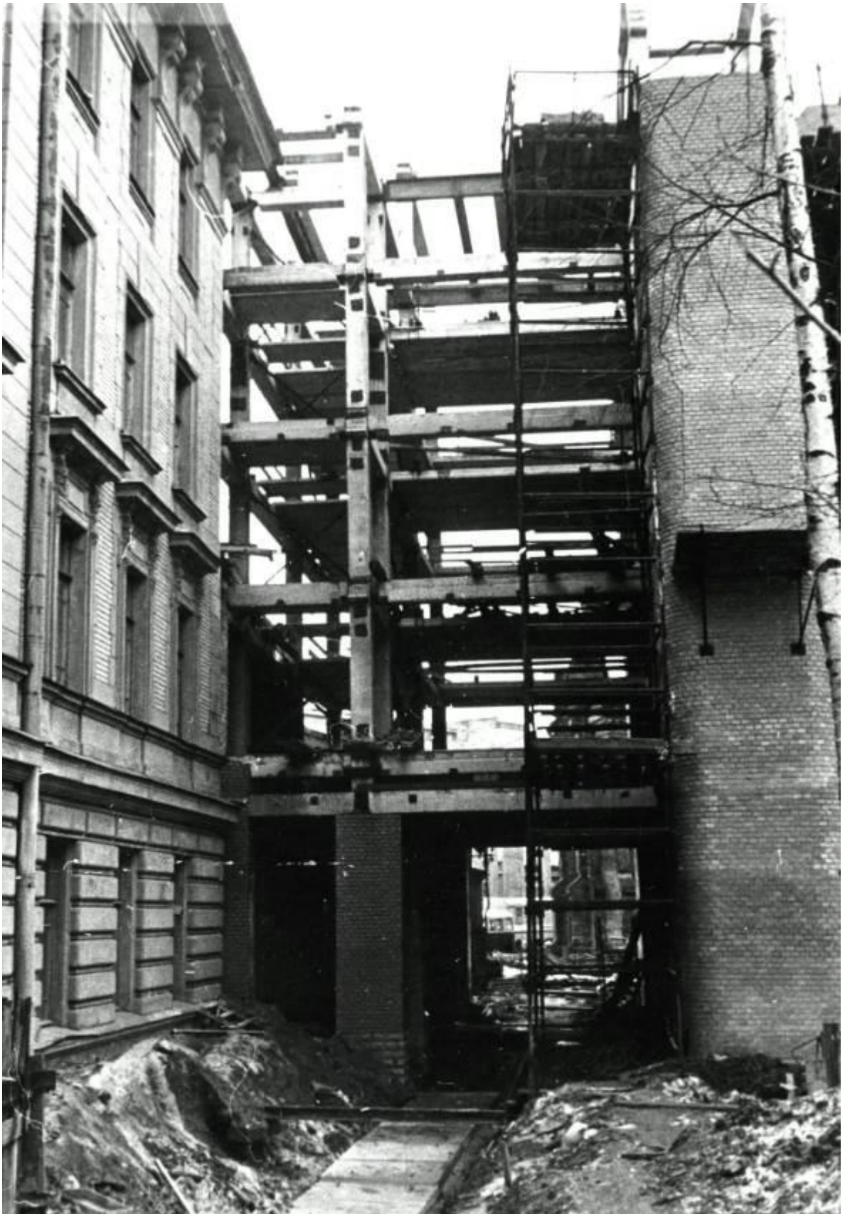
62. Фото 1970-е гг. Строительство пятого корпуса
