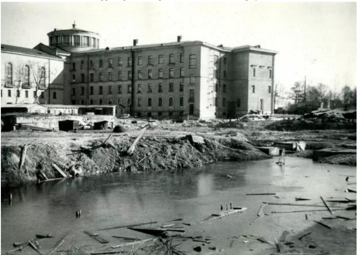
53. Фото около 1970 г. Начало строительства пятого корпуса
