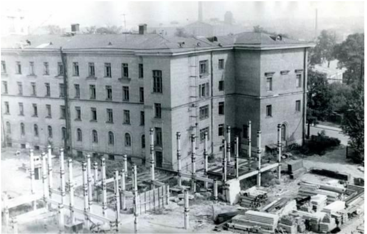
58. Фото около 1970 г. Начало строительства пятого корпуса
