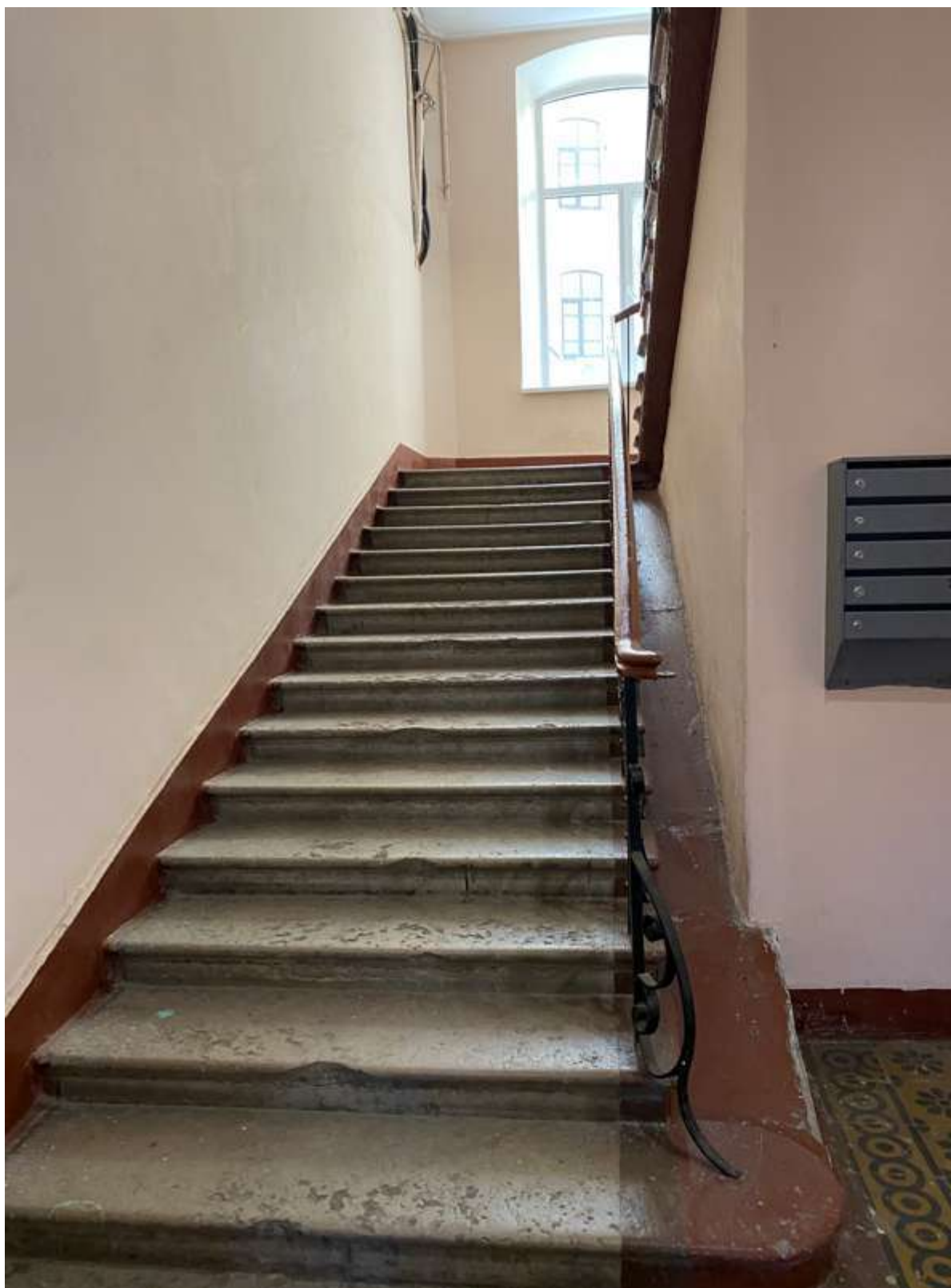
48. Фрагмент интерьера ЛКЗ
