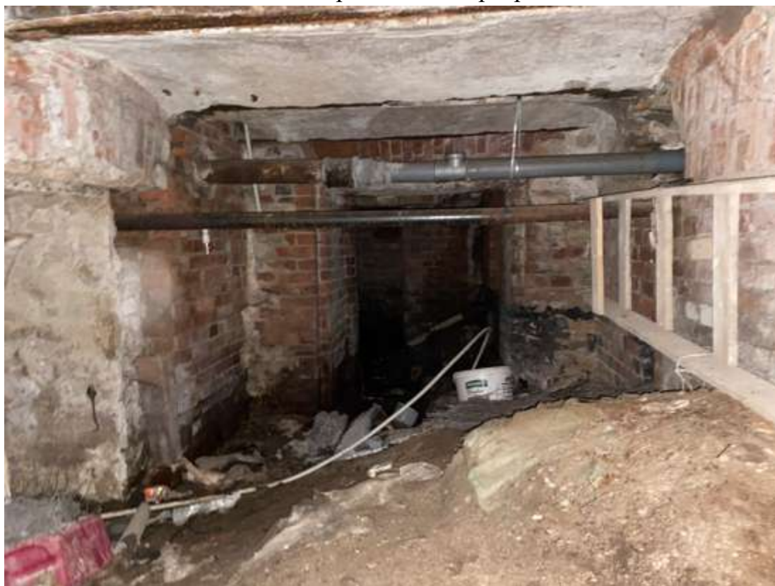
152. Фрагмент интеръера подвала
