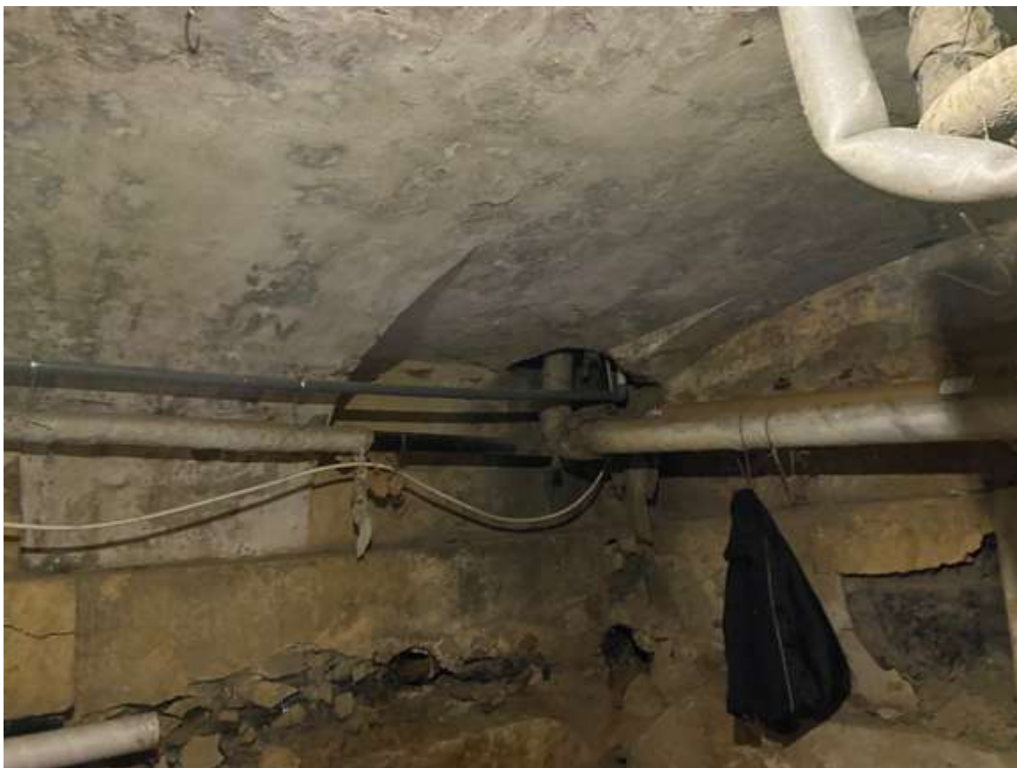
90. Фрагмент интеръера подвала
