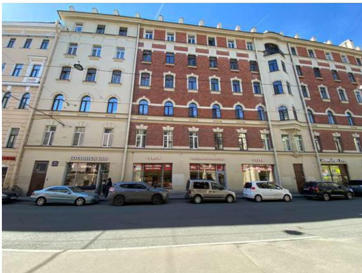
18. Фрагмент фасада со стороны переулка Гривцова
