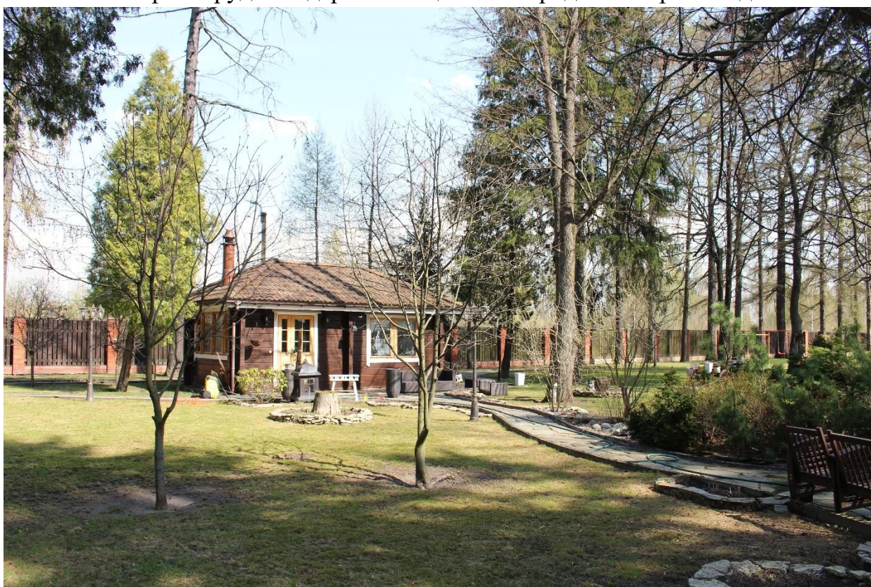
Фото 11. Вид на центральную часть выявленного объекта культурного наследия «Парк с прудом и деревьями ценных пород», вид на север.
