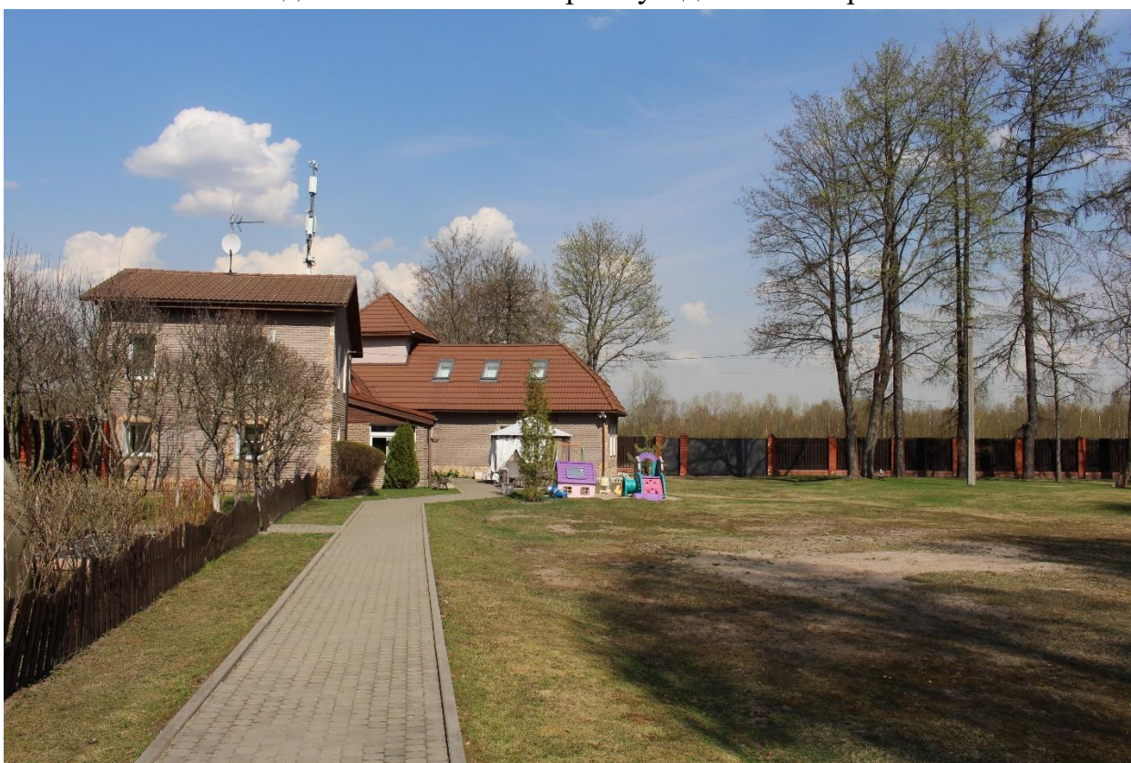
Фото 45. Вид на выявленные объекты культурного наследия «Флигель (каменный 2-этажный)», «Флигель с водонапорной башней (каменный)» с юга.
