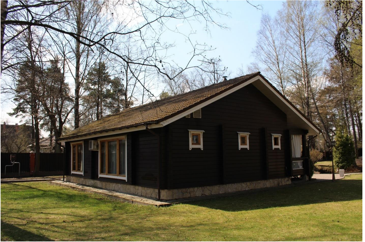
Фото 18. Вид на деревянное нежилое строение в восточной части выявленного объекта культурного наследия «Парк с прудом и деревьями ценных пород».
