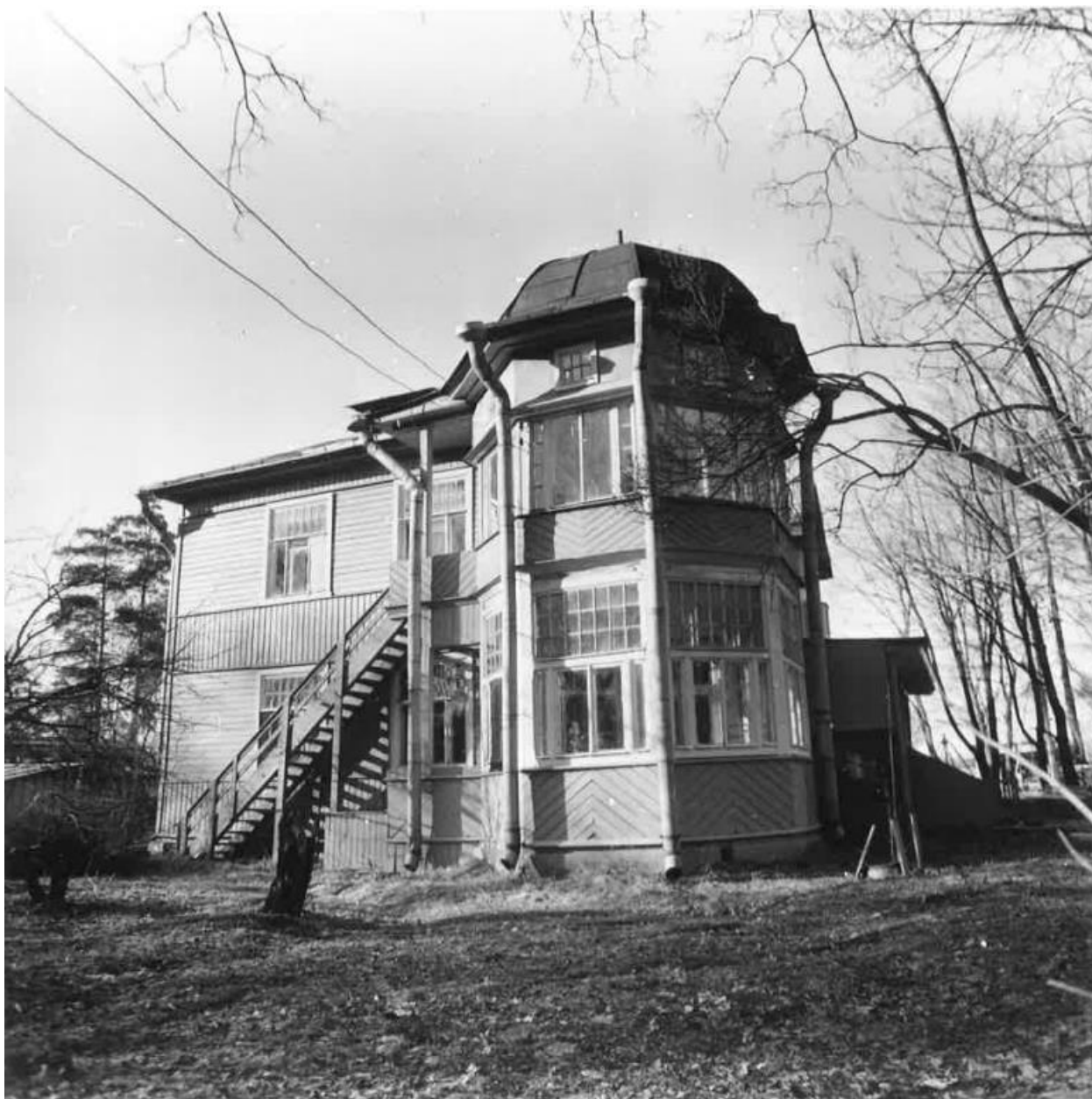
Илл. 43. Усадьба Польша. Ольгино, ул. Коммунаров, 13. Граничная ул. 1990 г. (источник: архив КГИОП. П-935).
