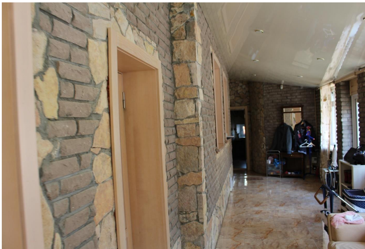
Фото 60. Внутреннее помещение пристроенного тамбура.
