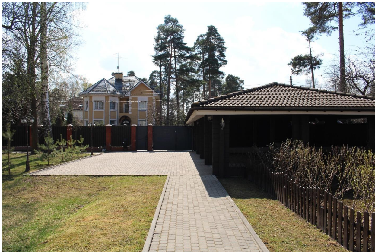
Фото 46. Вид на навес в юго-западной части выявленного объекта культурного наследия «Комплекс построек усадьбы Польша».
