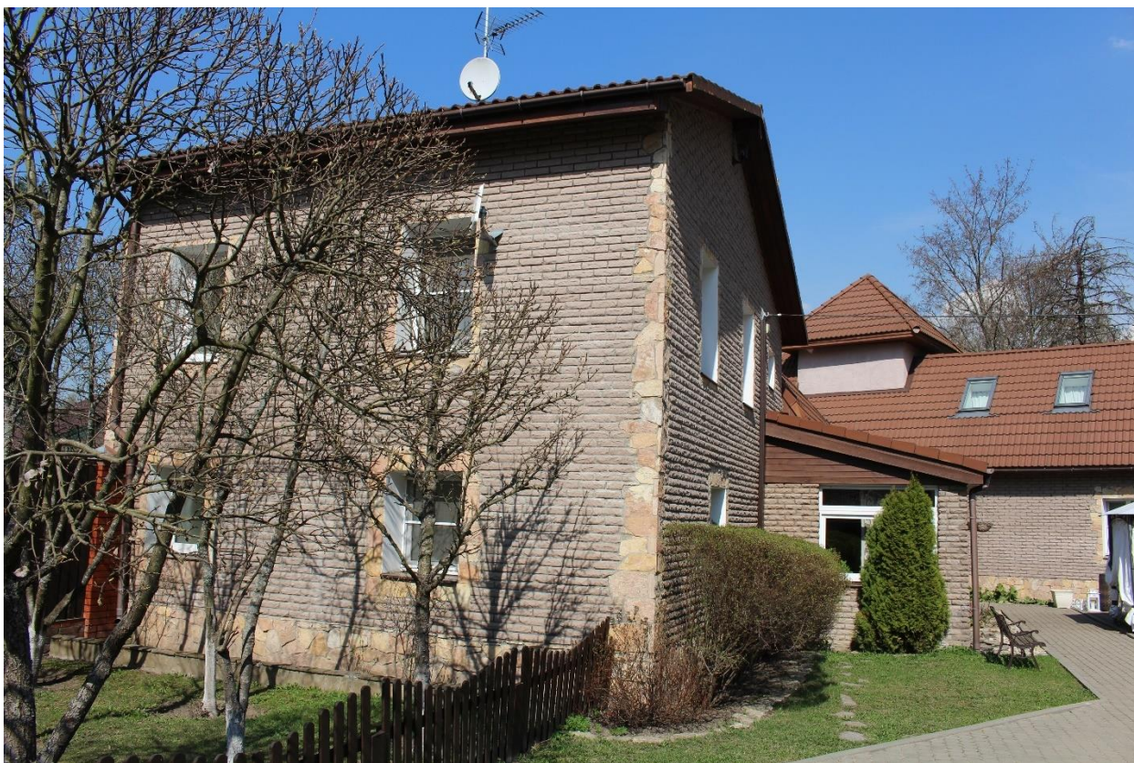
Фото 52. Вид на южный фасад выявленного объекта культурного наследия «Флигель (каменный 2-этажный)».
