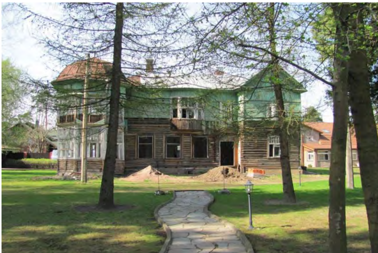
Илл. 58. Вид из глубины территории на 2-х этажное деревянное здание (восточный фасад). 2015 г. (источник: Акт ГИКЭ рег. № 01-24-2401/17 от 03.07.2017 г.).
