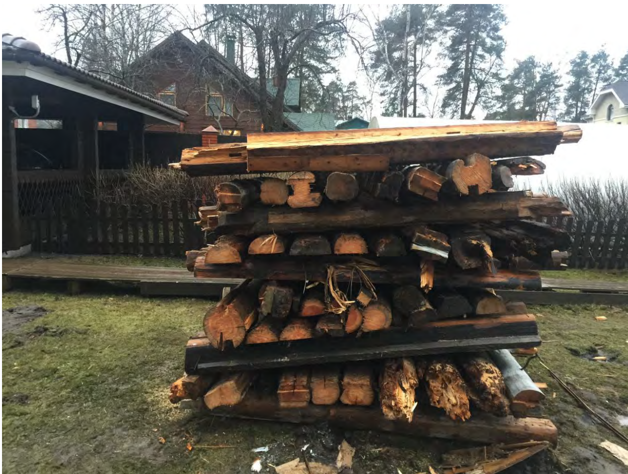
Илл. 67. Разборка деревянного двухэтажного здания в 2017 году (источник: фотография предоставлена собственником).
