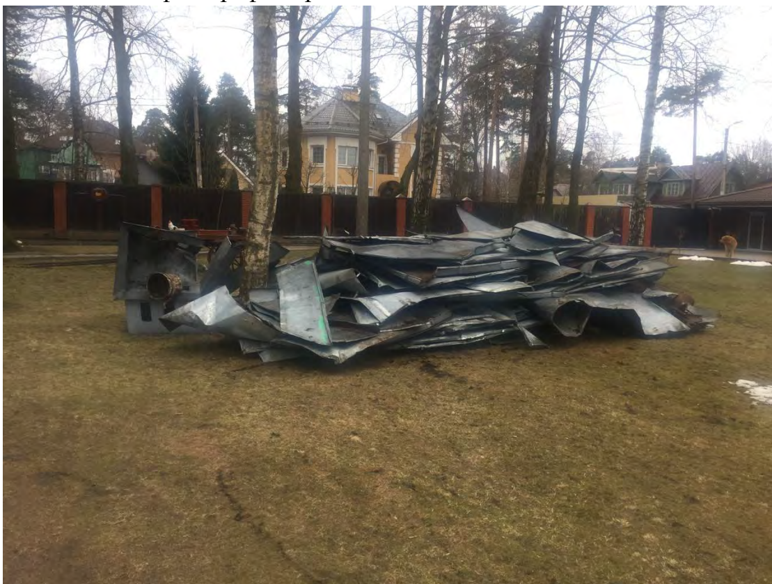
Илл. 70. Разборка деревянного двухэтажного здания в 2017 году (источник: фотография предоставлена собственником).
