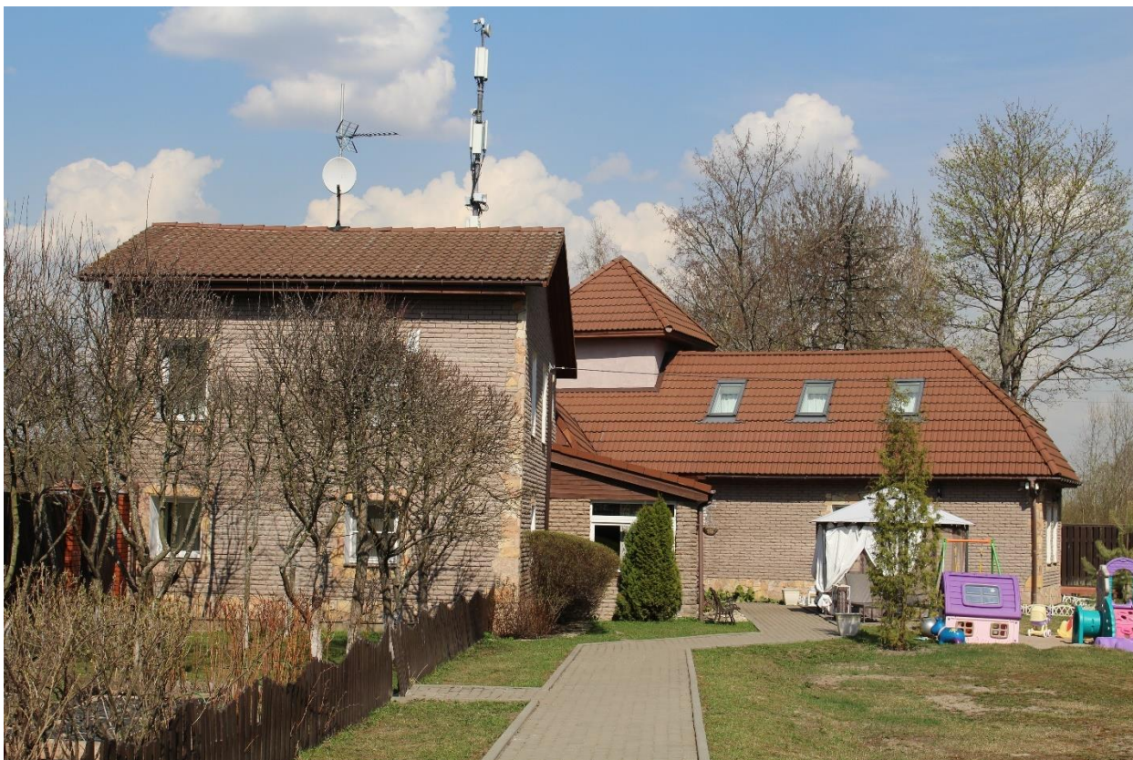
Фото 51. Вид на выявленные объекты культурного наследия «Флигель (каменный 2-этажный)», «Флигель с водонапорной башней (каменный)» с юга.
