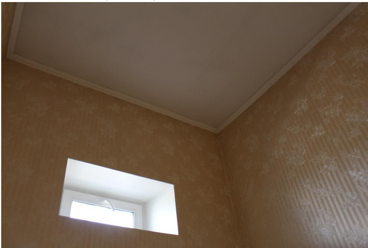
Фото 79. Внутренние помещения выявленных объектов культурного наследия «Флигель (каменный 2-этажный)», «Флигель с водонапорной башней (каменный)». 4-Н. Помещение № 4.
