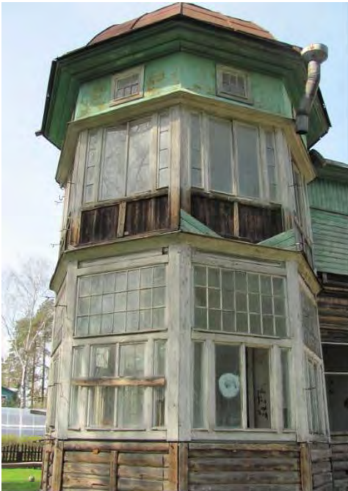
Илл. 61. Вид на веранду в юго-восточной части 2-х этажного деревянного здания. 2015 г. (источник: Акт ГИКЭ рег. № 01-24-2401/17 от 03.07.2017 г.).
