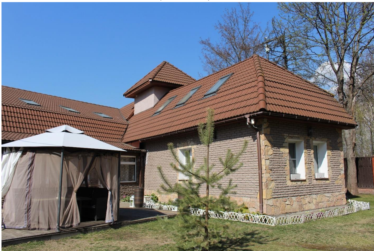
Фото 55. Вид на южный и восточный фасады выявленного объекта культурного наследия «Флигель с водонапорной башней (каменный)».
