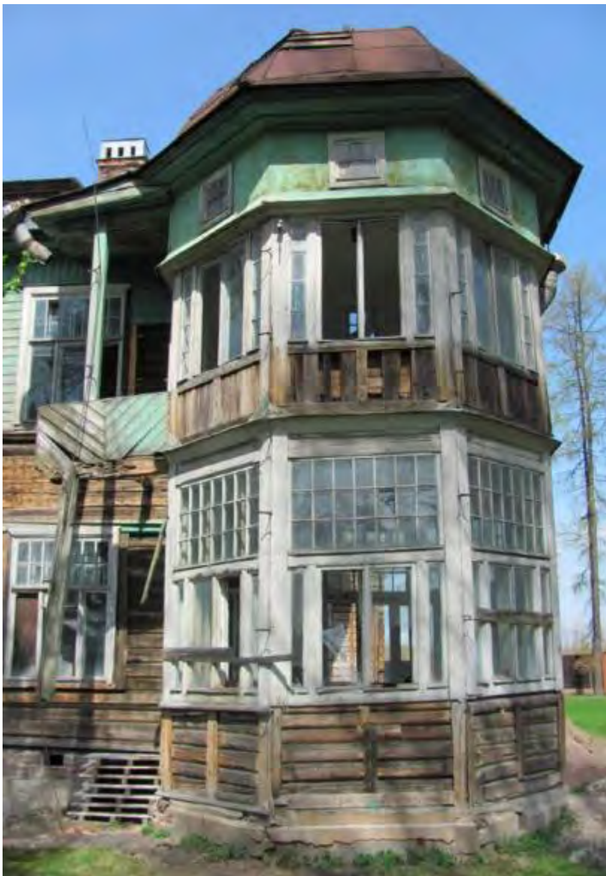
Илл. 62. Вид на веранду в юго-восточной части 2-х этажного деревянного здания. 2015 г. (источник: Акт ГИКЭ рег. № 01-24-2401/17 от 03.07.2017 г.).
