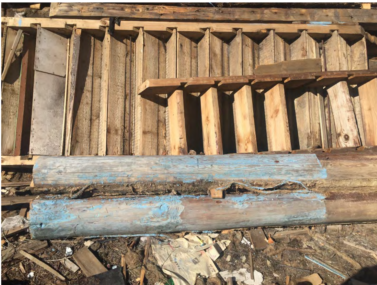
Илл. 69. Разборка деревянного двухэтажного здания в 2017 году (источник: фотография предоставлена собственником).
