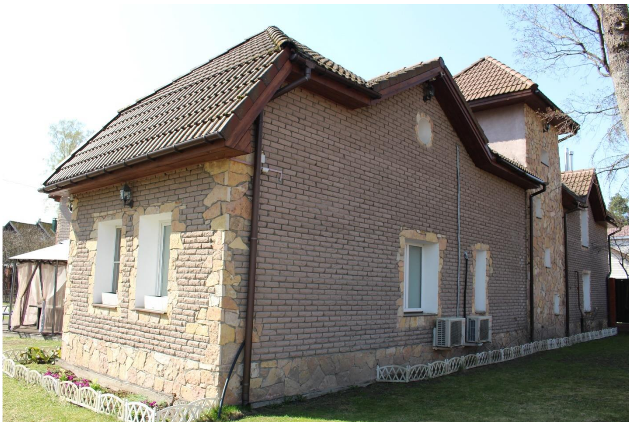
Фото 58. Вид на северный фасад выявленного объекта культурного наследия «Флигель с водонапорной башней (каменный)».
