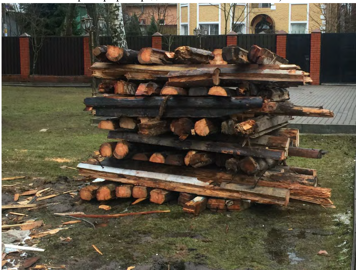
Илл. 66. Разборка деревянного двухэтажного здания в 2017 году (источник: фотография предоставлена собственником).
