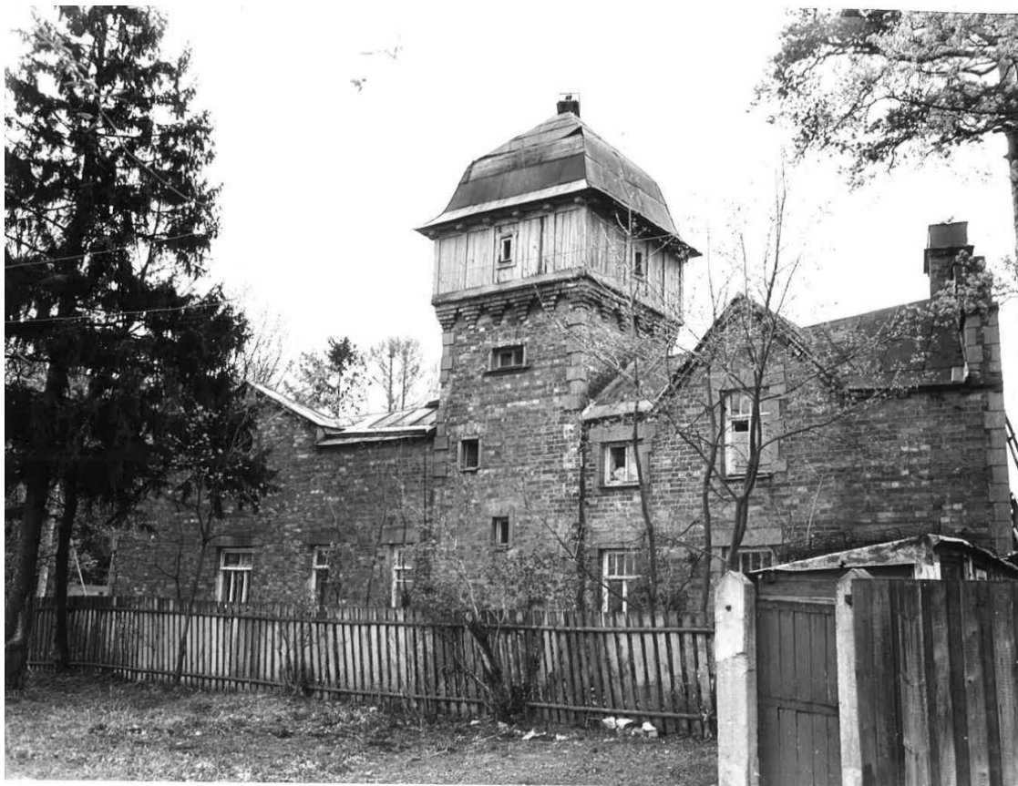
Илл. 46. Усадьба Польшрока. Ольгино, ул. Коммунаров, 13. Граничная ул. 1995 г. (источник: архив КГИОП. П-935).
