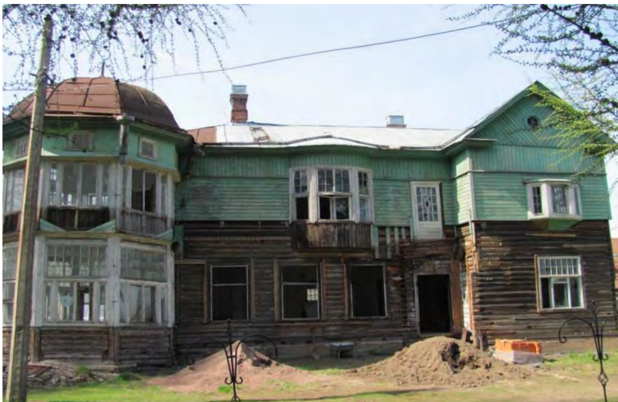
Илл. 60. Вид на восточный фасад двухэтажного деревянного здания. 2015 г. (источник: Акт ГИКЭ рег. № 01-24-2401/17 от 03.07.2017 г.).
