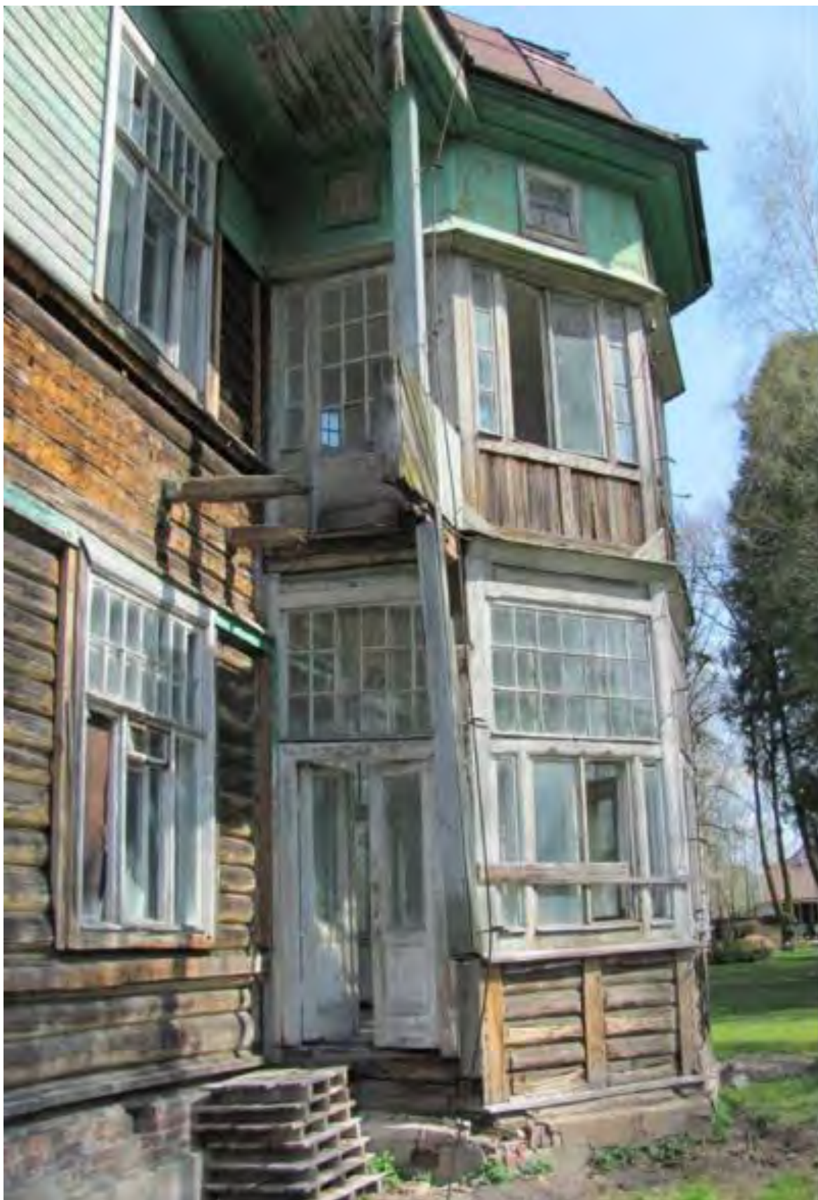
Илл. 63. Вид на веранду в юго-восточной части 2-х этажного деревянного здания. 2015 г. (источник: Акт ГИКЭ рег. № 01-24-2401/17 от 03.07.2017 г.).
