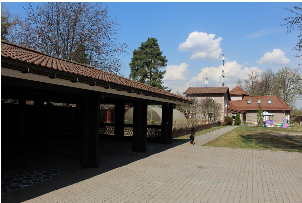
Фото 44. Вид на навес в юго-западной части выявленного объекта культурного наследия «Комплекс построек усадьбы Польша».
