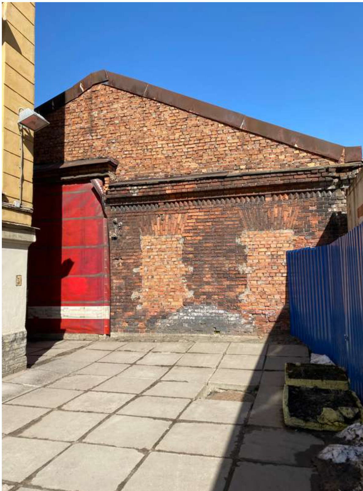
21. Торцевой фасад здания служб
