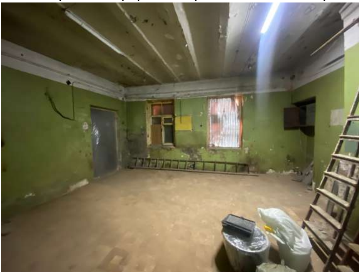
37. Фрагмент интерьера здания, примыкающего к зданию служб
