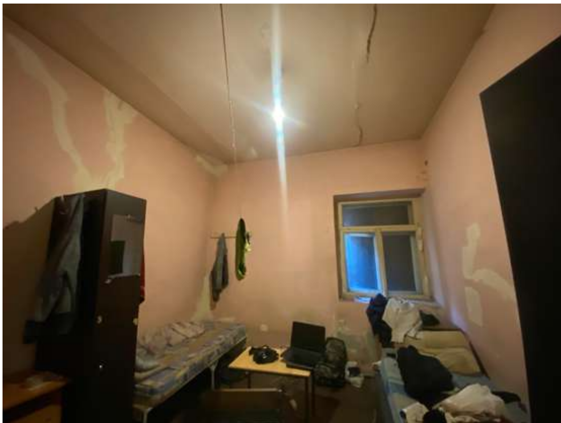
34. Фрагмент интеръера здания служб
