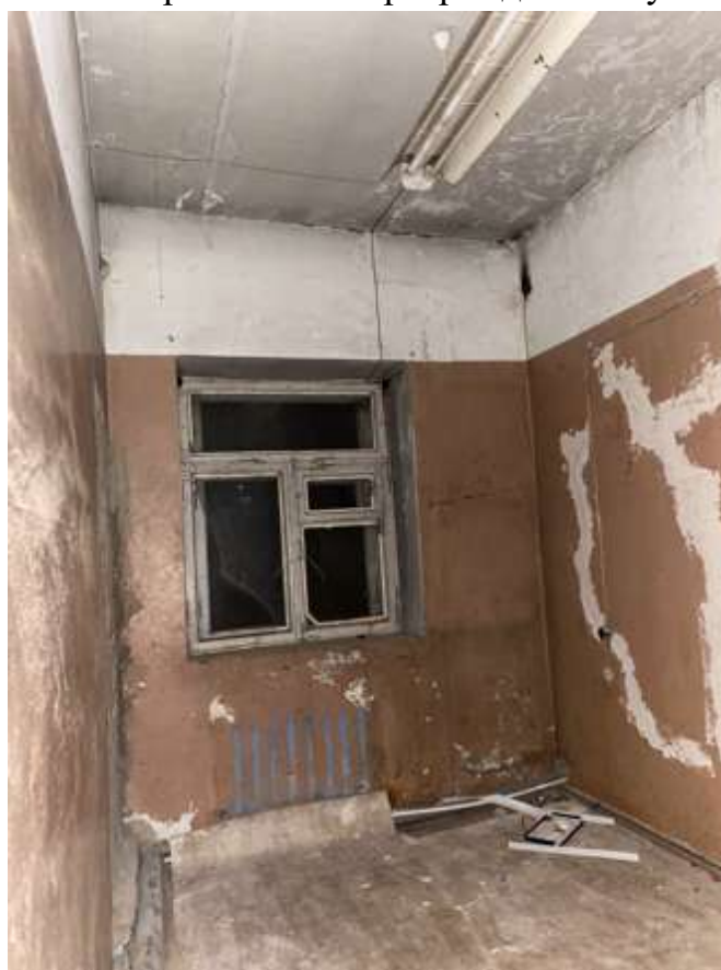
35. Фрагмент интеръера здания служб
