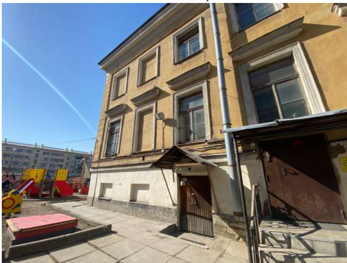
23. Фрагмент восточного фасада
