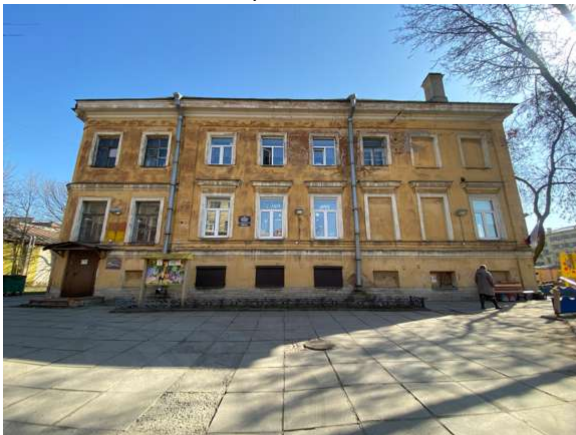
12. Вид на западный фасад
