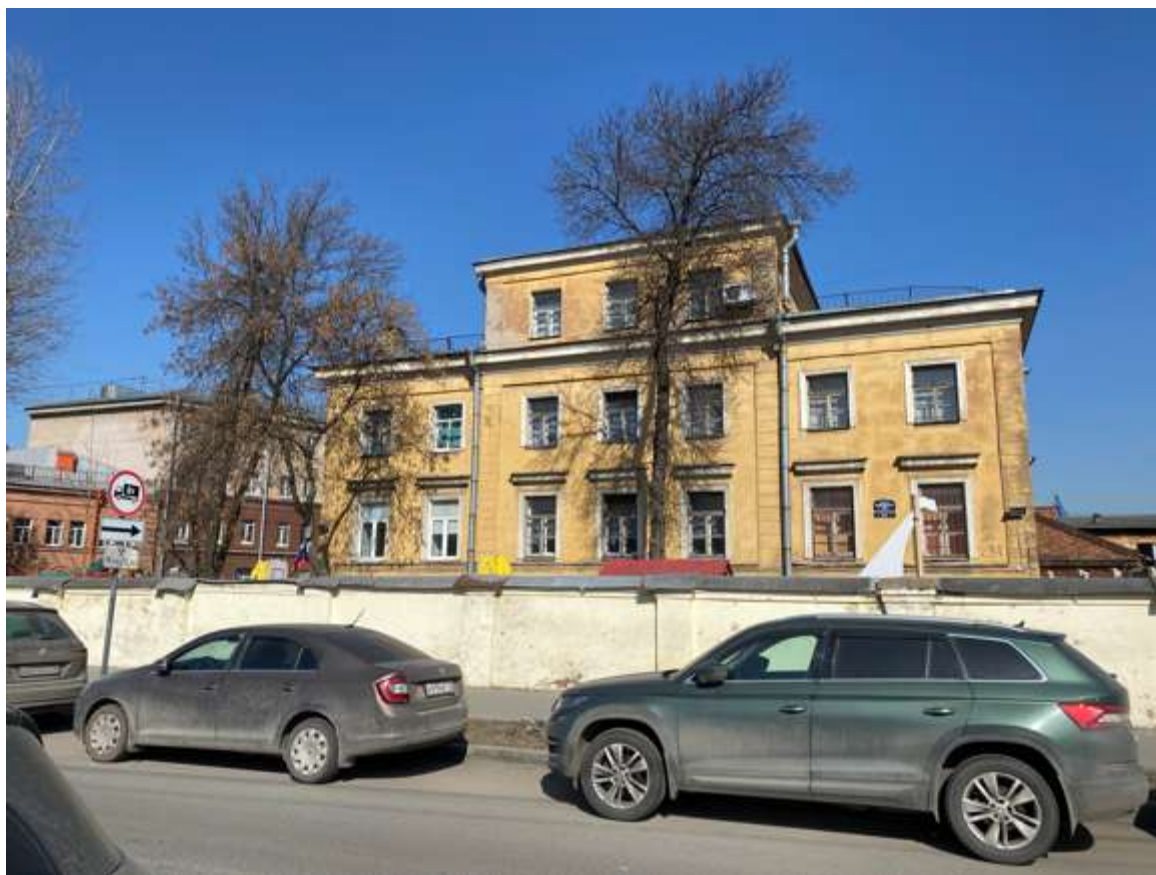
2. Вид с Обводного канала
