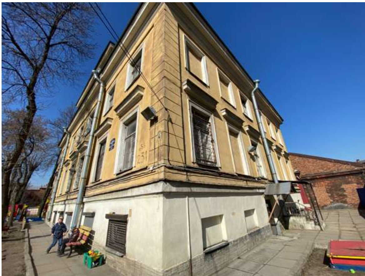
24. Вид на юго-восточный угол здания
