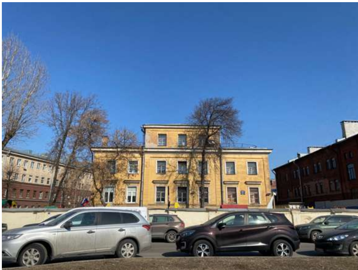
1. Вид с Обводного канала
