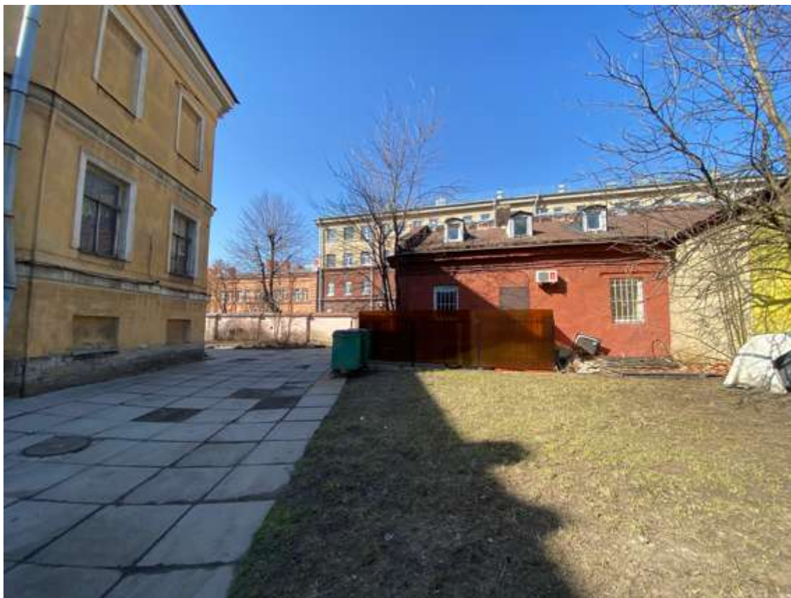
19. Вид вдоль северного фасада
