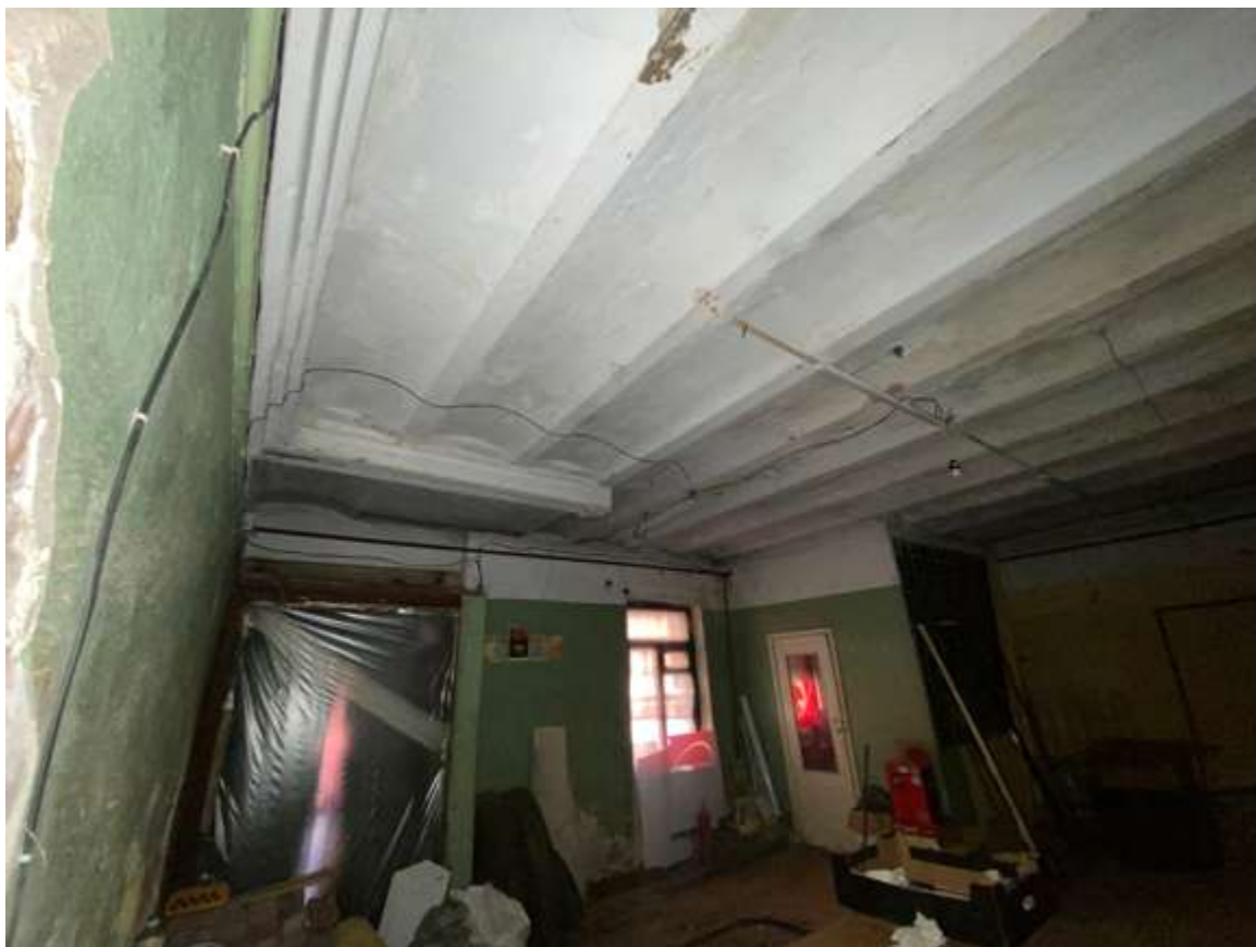
36. Фрагмент интерьера здания, примыкающего к зданию служб
