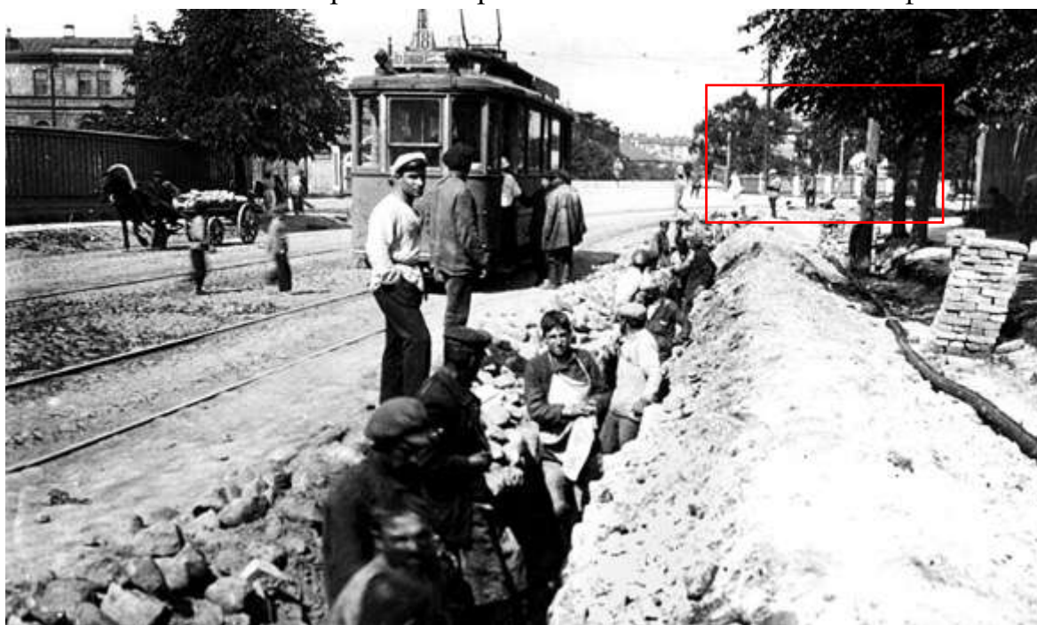
32. Прокладка кабеля 35 кВ. 1925 г. [Электронный ресурс] URL: https://pastvu.com/p/121773
