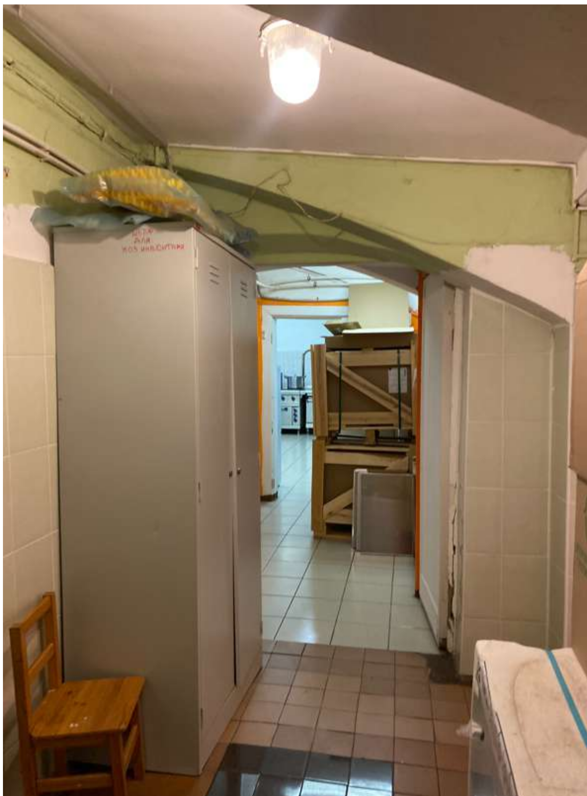
44. Фрагмент інтер'єра цокольного этажа
