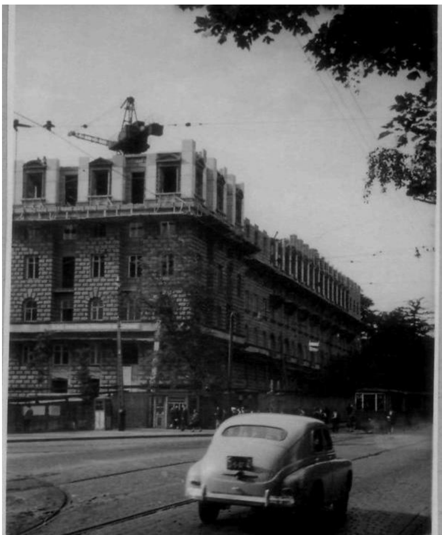
24. ЦГАКФФД СПб. Ар 37948. Вид строящегося стоквартирного жилого дома поточно-скоростным методом на проспекте Карла Маркса. 17.08.1953 г.
