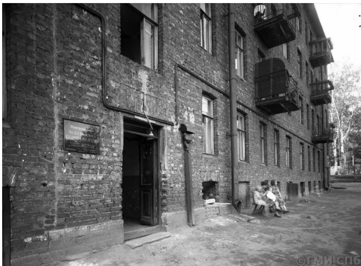
14. ГМИ СПб Инв.№-II-A-975 н. Сердобольская улица, дом 1. Дворовый фасад. 1938-39 гг.
