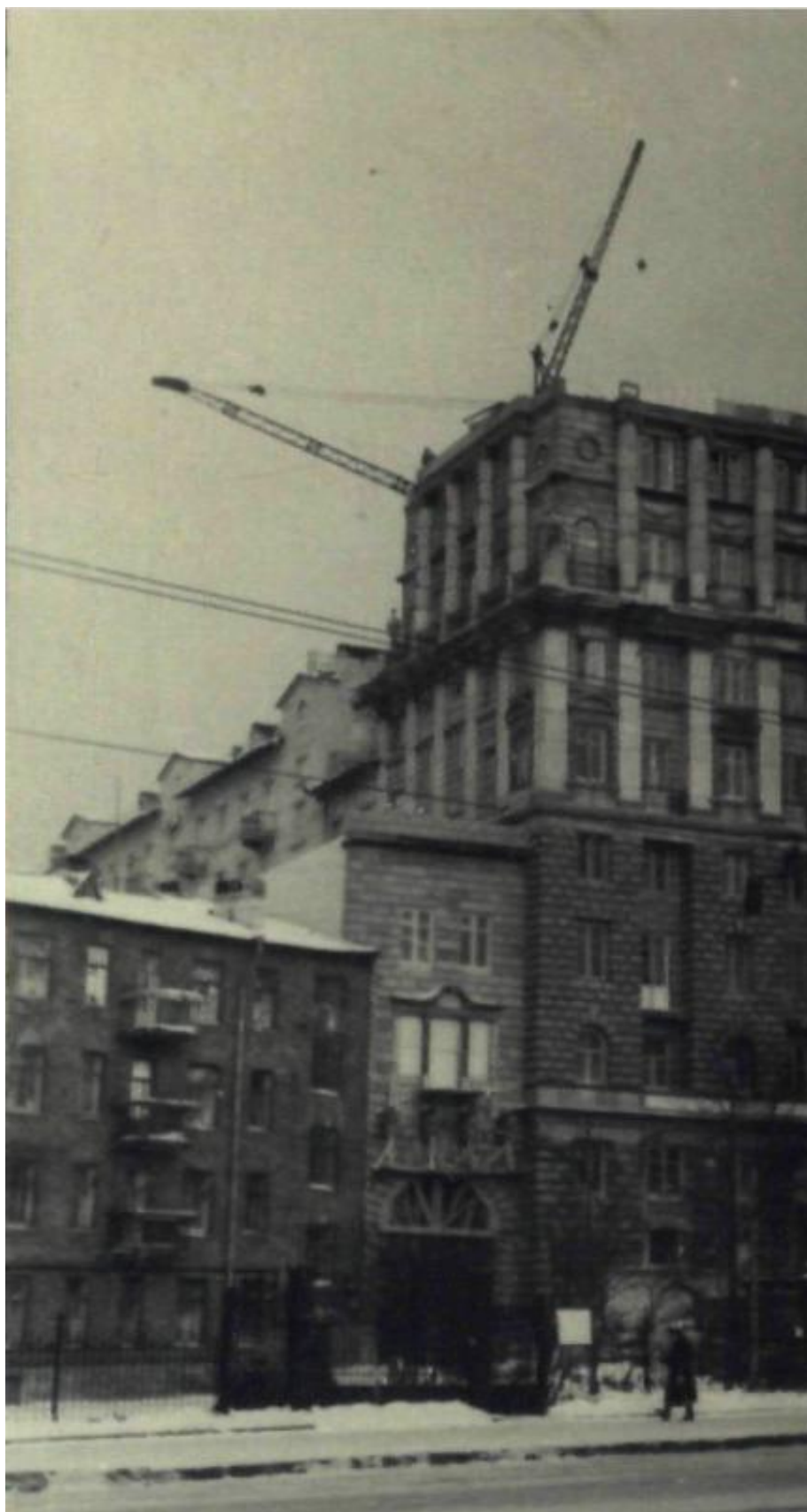
28. ЦГАКФФД СПб. Ар 44987. Сооружение многоэтажной башни жилого дома на углу проспекта Карла Маркса и Сердобольской улицы. 13.02.1954 г.
