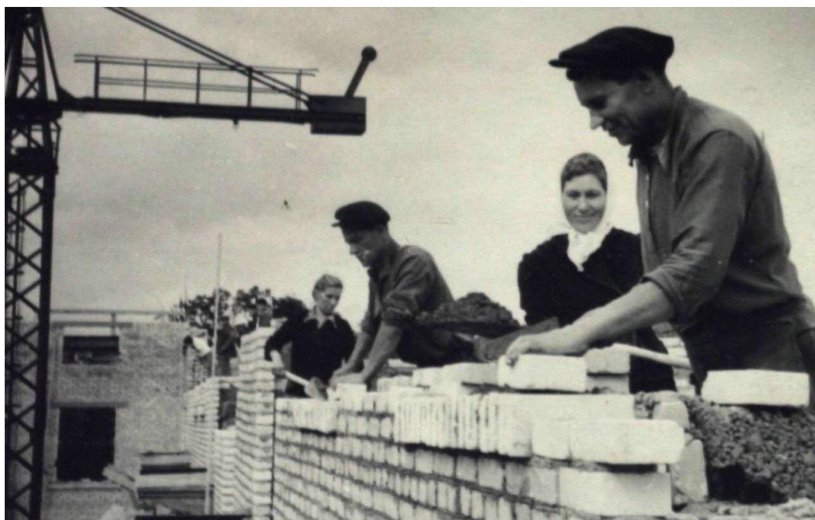
26. ЦГАКФФД СПб. Ар 37947. Каменщик Н.К. Сидоренко, выполняющий по две нормы, и подсобница М.И. Сидоренко за кладкой стены седьмого этажа на строительстве нового стоквартирного дома на углу проспекта Карла Маркса и Сердобольской улицы 17.08.1953 г.
