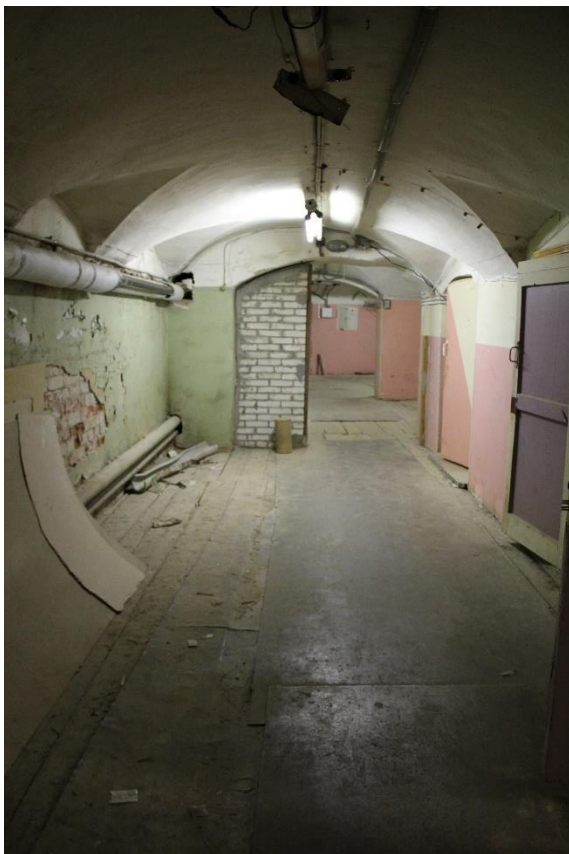
Фото 3. Вид на помещение 3-Н (7).
