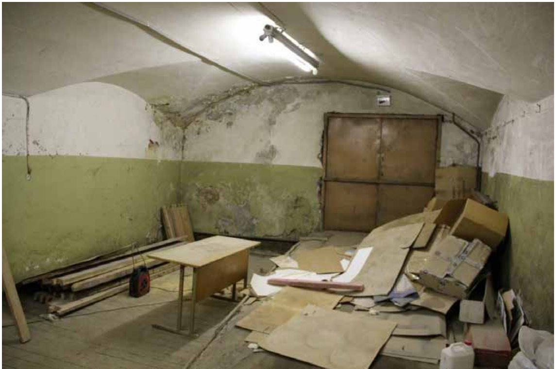
Фото 2. Вид на помещение 3-Н (6).
