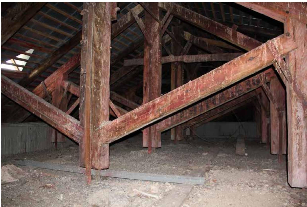
Фото 70. Вид на чердачное пространство.
