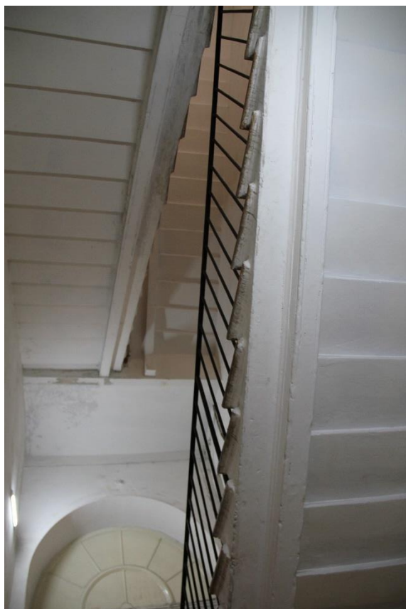
Фото 49. Лестница в юго-восточной части корпуса 1883 г.
