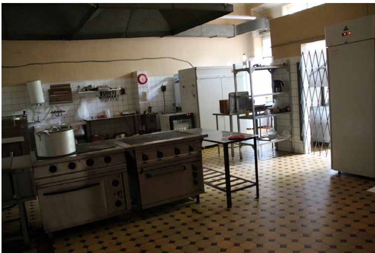
Фото 39. Вид на пом. 1-Н (98).
