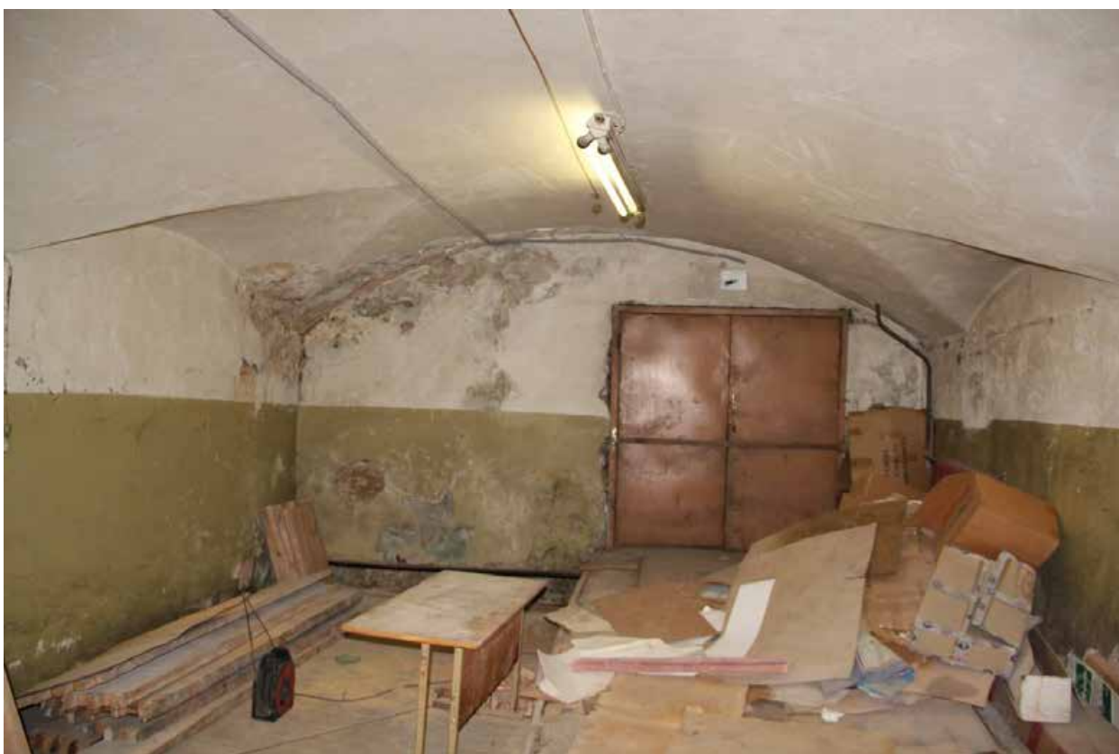
Фото 16. Вид на помещение 3-Н (24).
