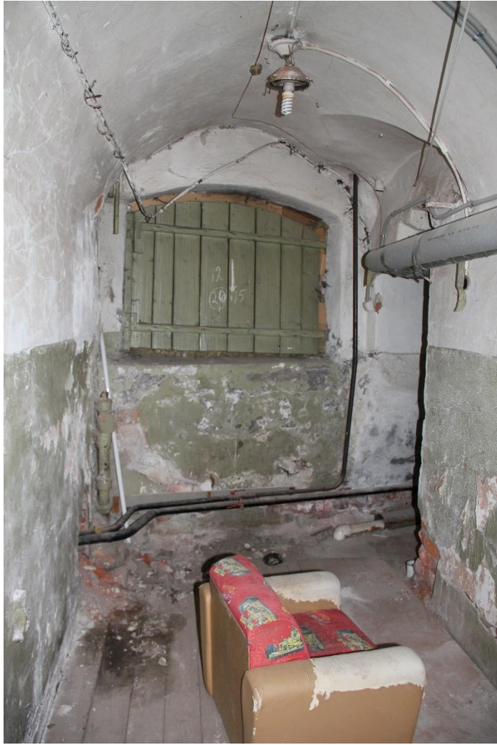
Фото 1. Вид на помещение 3-Н (1).
