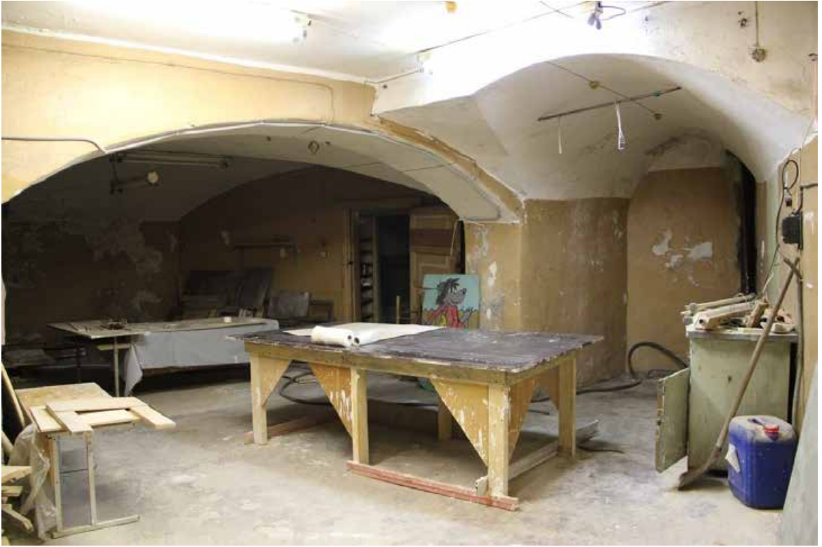
Фото 11. Вид на помещение 3-Н (15).
