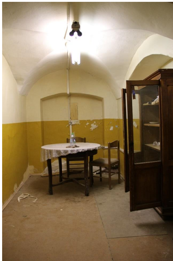
Фото 4. Вид на помещение 3-Н (8).
