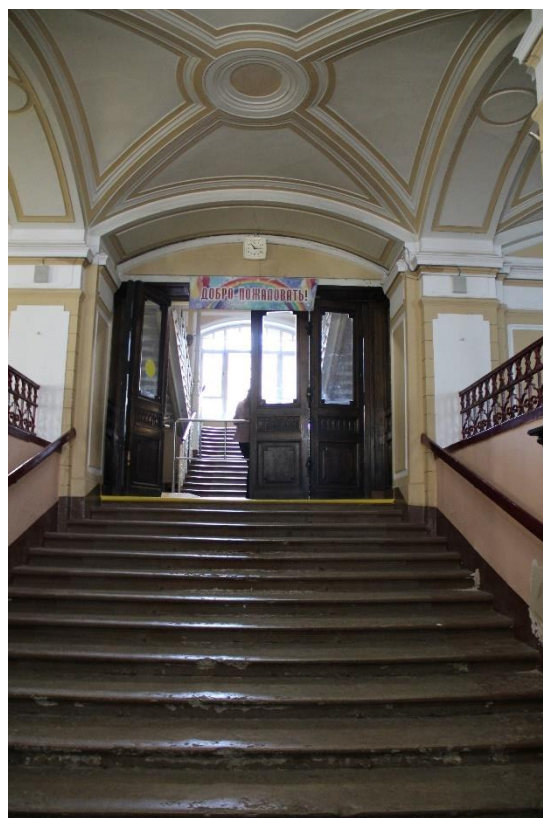
Фото 25. Лестница в пом. 1-Н (3).
