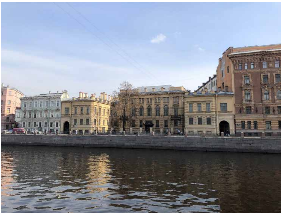
Фото 1. Лицевой фасад дома № 62 по набережной р. Фонтанки.
