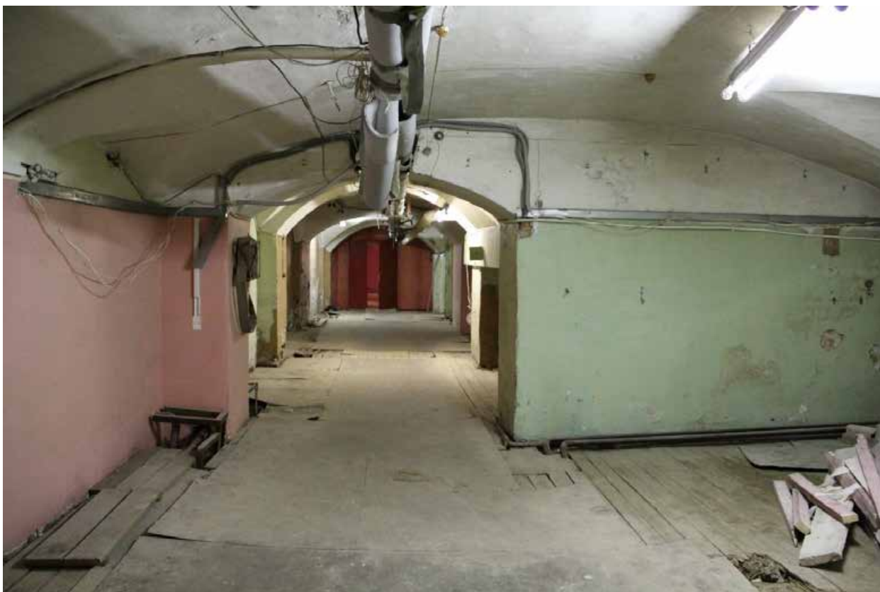
Фото 9. Вид на помещение 3-Н (21).
