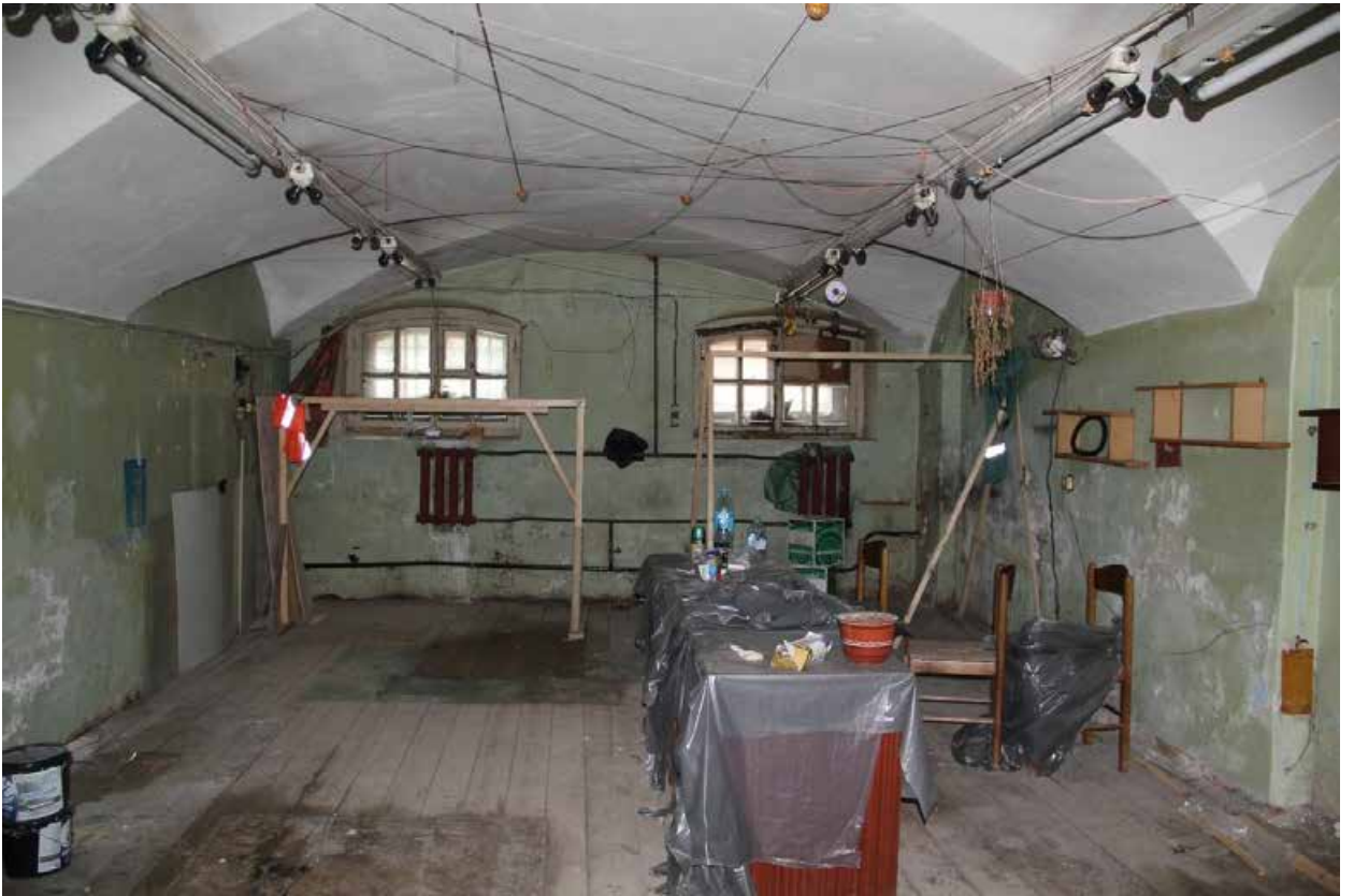
Фото 14. Вид на помещение 3-Н (29).
