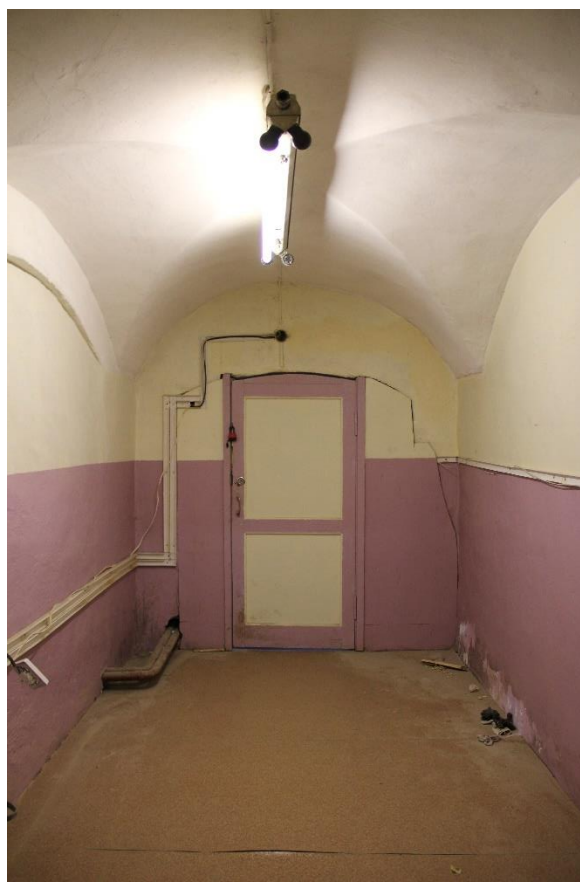
Фото 6. Вид на помещение 3-Н (11).
