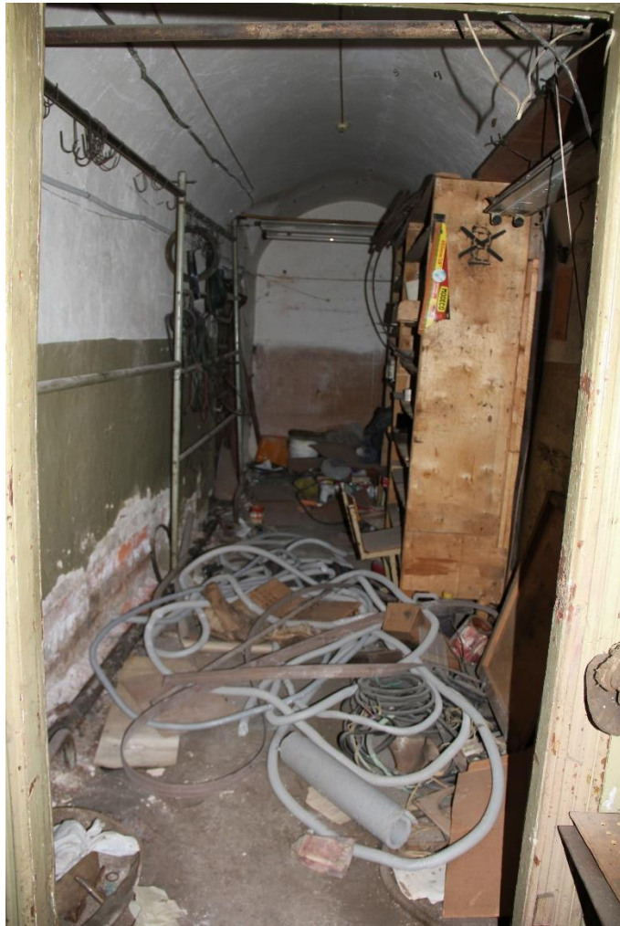
Фото 12. Вид на помещение 3-Н (18).
