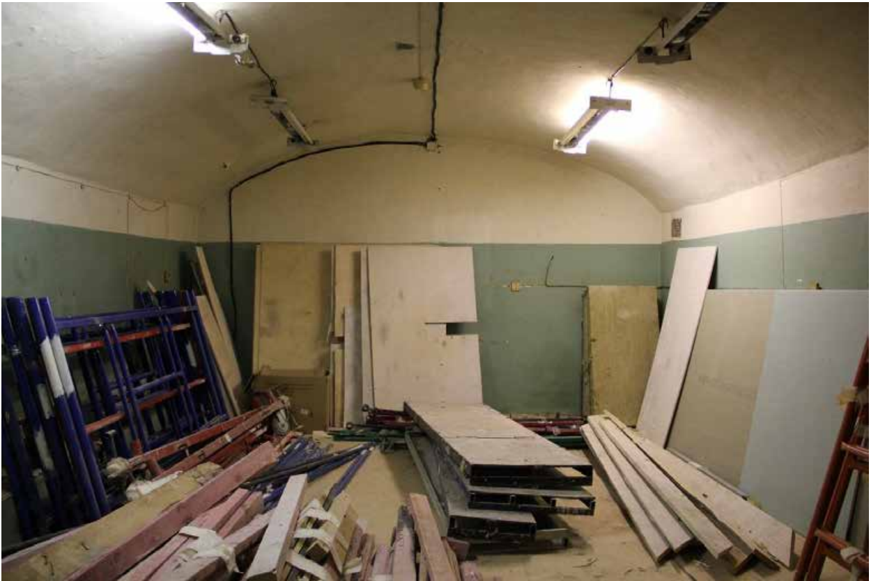
Фото 8. Вид на помещение 3-Н (17).
