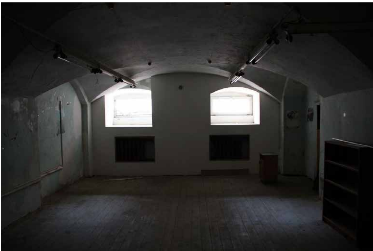
Фото 15. Вид на помещение 3-Н (28).
