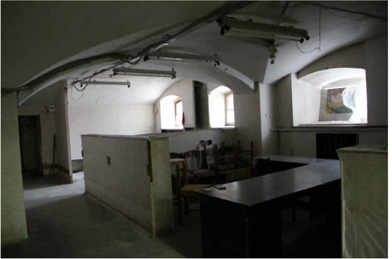
Фото 13. Вид на помещение 3-Н (19).
