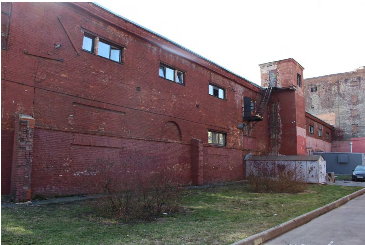
Фото 26. Вид на северо-западный фасад дворового корпуса выявленного объекта культурного наследия «Манеж и конюшни лейб-гвардии Гренадерского полка (здание тира лейб-гвардии Стрелкового батальона)». Фото 17.04.2023 г.
