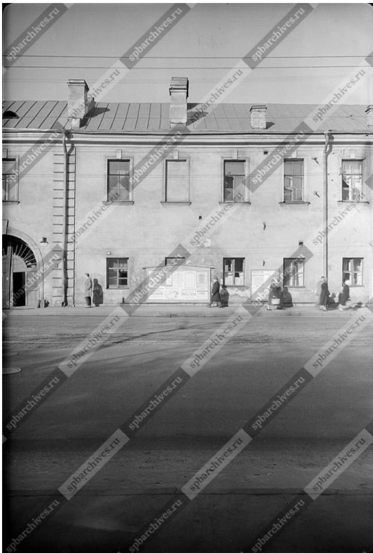
Илл. 37. Вид части фасада дома № 35 по Загородному проспекту. 1962 г. (источник: ЦГАКФФД СПб. Фотодокумент Бр 75203).
