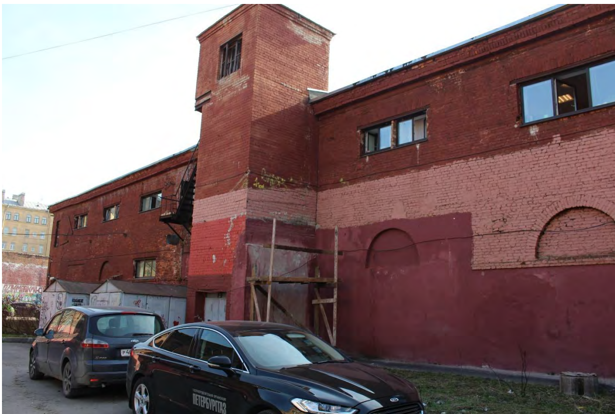
Фото 28. Вид на северо-западный фасад дворового корпуса выявленного объекта культурного наследия «Манеж и конюшни лейб-гвардии Гренадерского полка (здание тира лейб-гвардии Стрелкового батальона)». Фото 17.04.2023 г.
