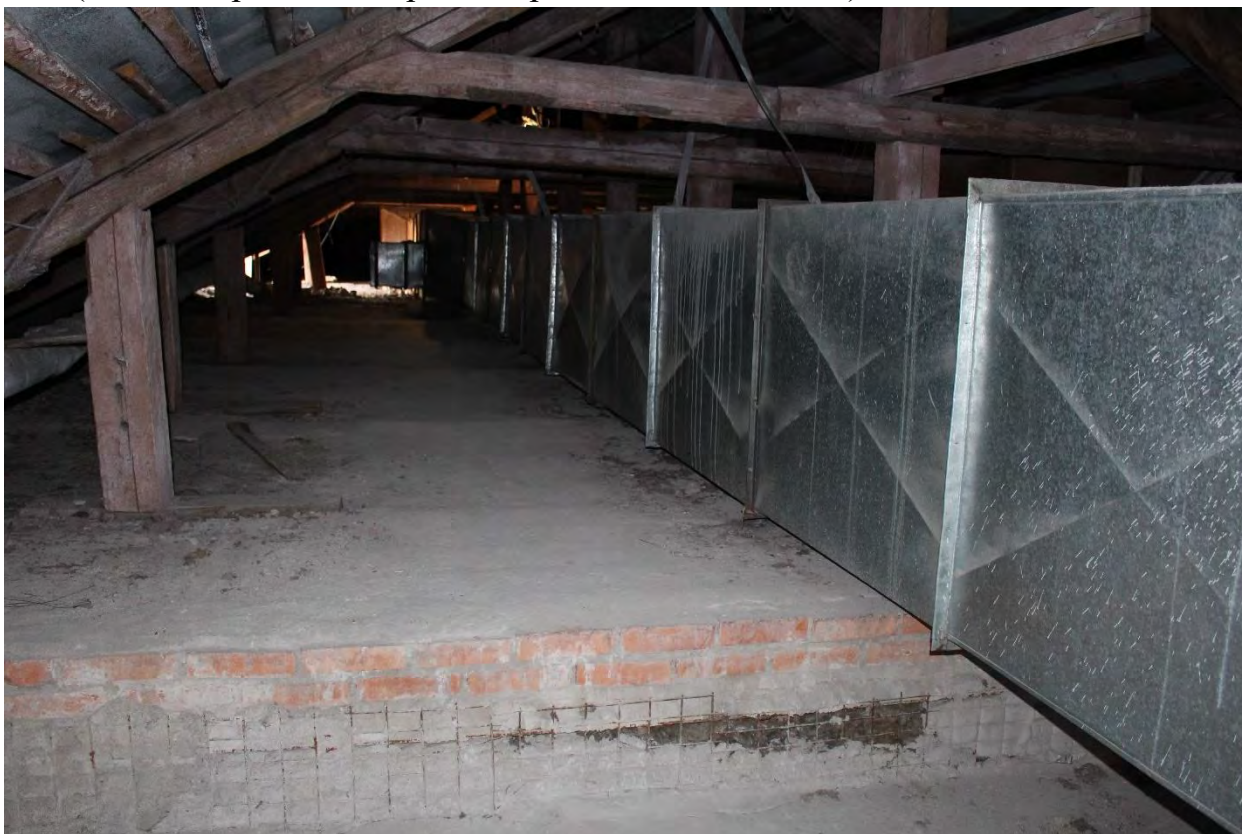
Фото 89. Чердачные помещения лицевого корпуса выявленного объекта культурного наследия «Манеж и конюшни лейб-гвардии Гренадерского полка (здание тира лейб-гвардии Стрелкового батальона)». Фото 22.05.2023 г.
