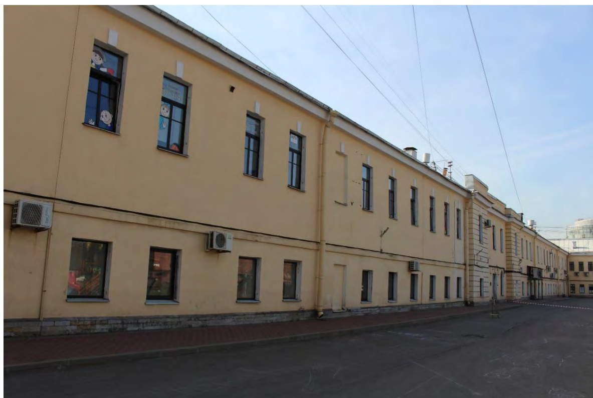
Фото 14. Вид на северо-восточный (дворовый) фасад лицевого корпуса выявленного объекта культурного наследия «Манеж и конюшни лейб-гвардии Гренадерского полка (здание тира лейб-гвардии Стрелкового батальона)». Фото 17.04.2023 г.
