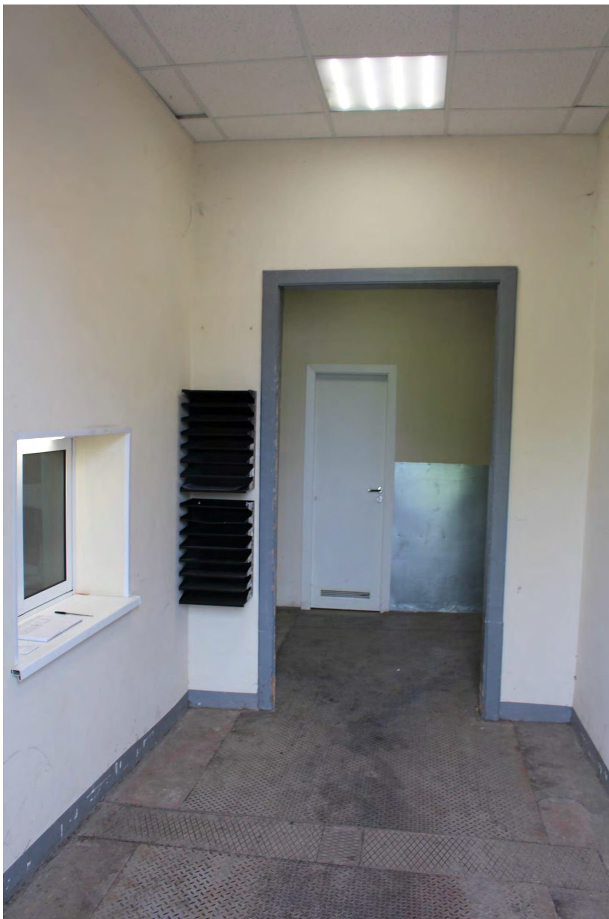
Фото 67. Внутренние помещения 1-го этажа лицевого корпуса выявленного объекта культурного наследия «Манеж и конюшни лейб-гвардии Гренадерского полка (здание тира лейб-гвардии Стрелкового батальона)». Фото 22.05.2023 г.
