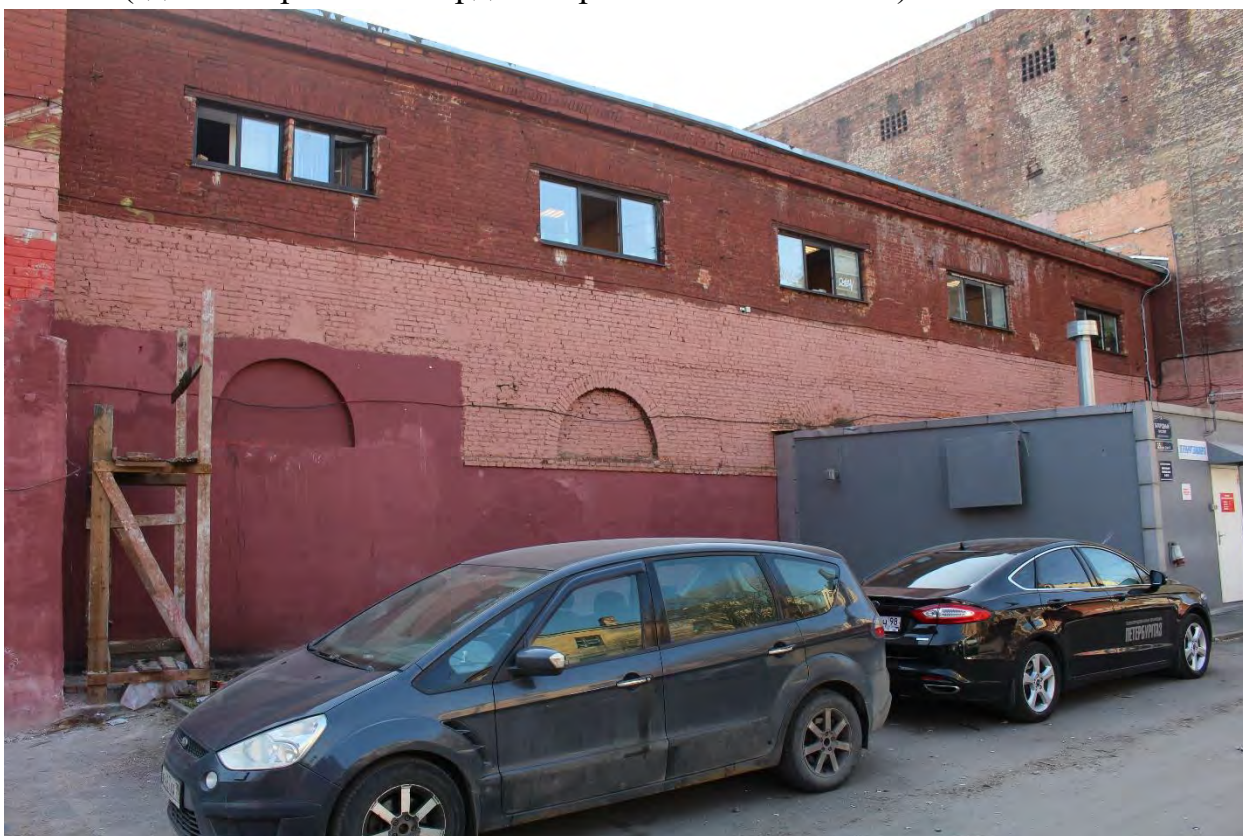
Фото 27. Вид на северо-западный фасад дворового корпуса выявленного объекта культурного наследия «Манеж и конюшни лейб-гвардии Гренадерского полка (здание тира лейб-гвардии Стрелкового батальона)». Фото 17.04.2023 г.
