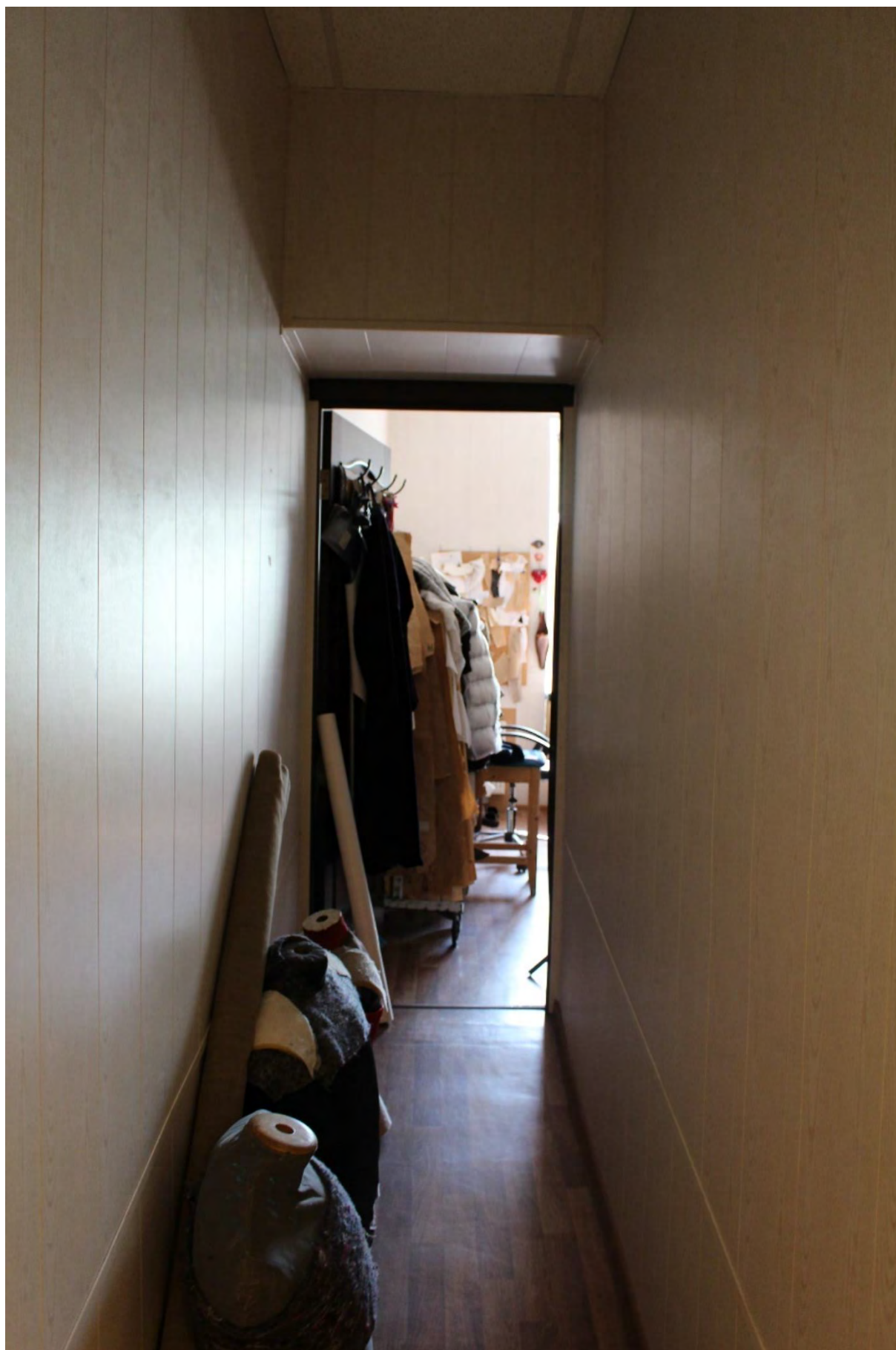
Фото 78. Внутренние помещения 2-го этажа лицевого корпуса выявленного объекта культурного наследия «Манеж и конюшни лейб-гвардии Гренадерского полка (здание тира лейб-гвардии Стрелкового батальона)». Фото 22.05.2023 г.
