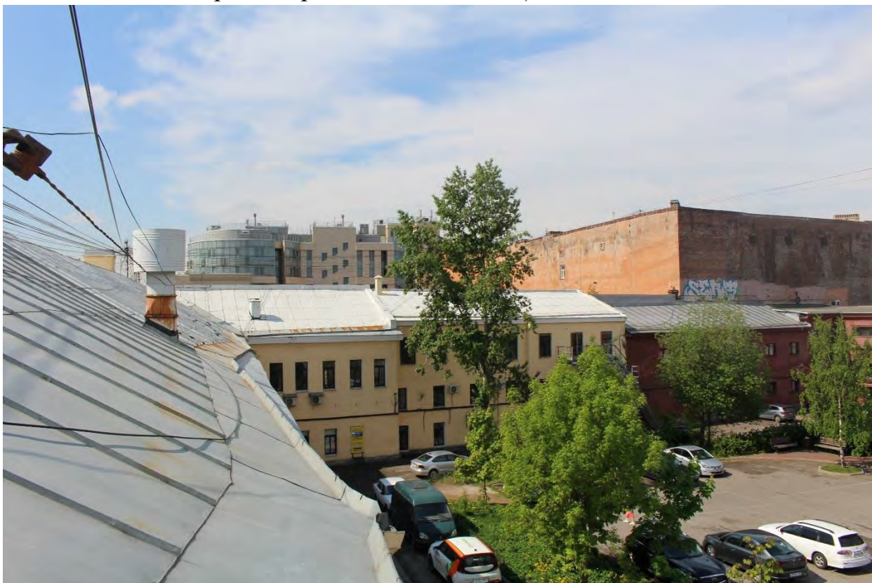
Фото 18. Вид с крыши лицевого корпуса выявленного объекта культурного наследия «Манеж и конюшни лейб-гвардии Гренадерского полка (здание тира лейб-гвардии Стрелкового батальона)». Фото 22.05.2023 г.
