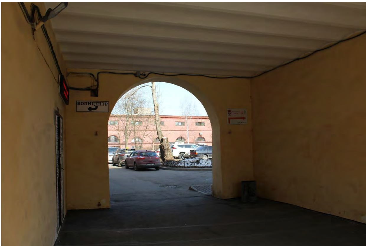
Фото 7. Арка воротного проезда лицевого корпуса выявленного объекта культурного наследия «Манеж и конюшни лейб-гвардии Гренадерского полка (здание тира лейб-гвардии Стрелкового батальона)». Фото 17.04.2023 г.
