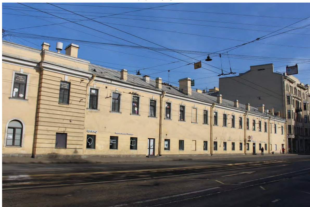
Фото 4. Вид на восточную часть юго-восточного фасада лицевого корпуса выявленного объекта культурного наследия «Манеж и конюшни лейб-гвардии Гренадерского полка (здание тира лейб-гвардии Стрелкового батальона)». Фото 17.04.2023 г.
