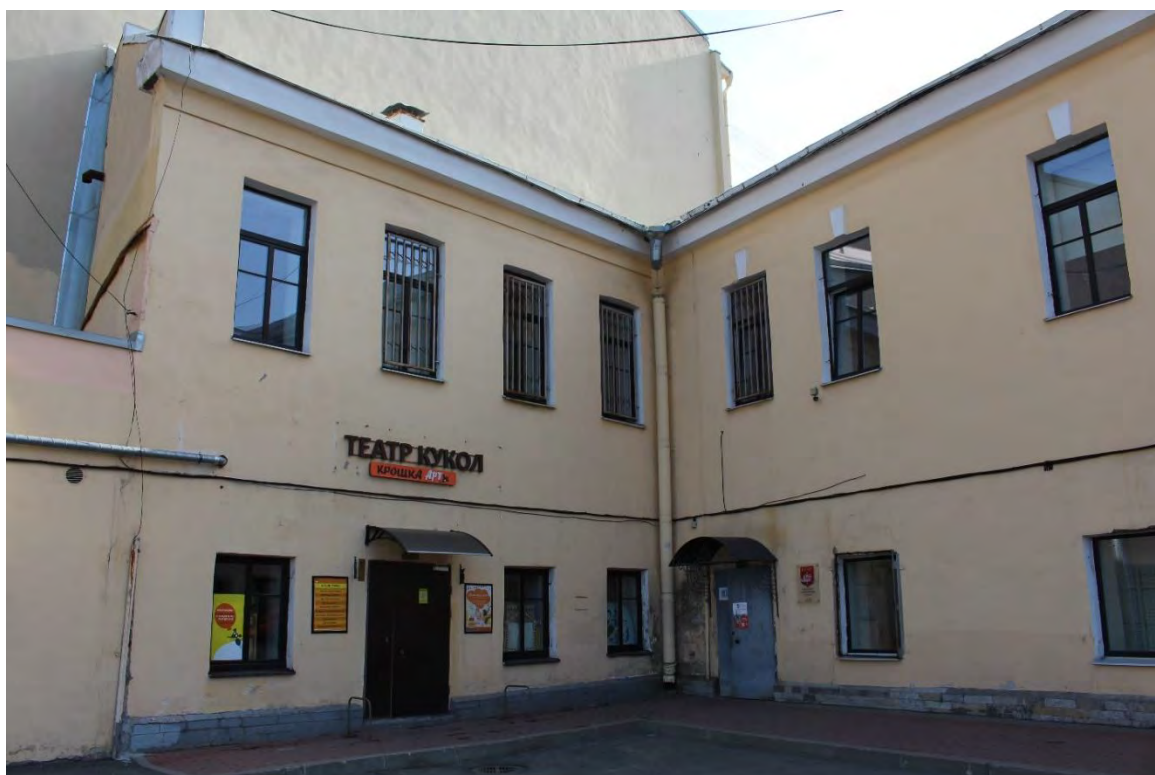
Фото 13. Вид на северо-восточный (дворовый) фасад лицевого корпуса выявленного объекта культурного наследия «Манеж и конюшни лейб-гвардии Гренадерского полка (здание тира лейб-гвардии Стрелкового батальона)». Фото 17.04.2023 г.
