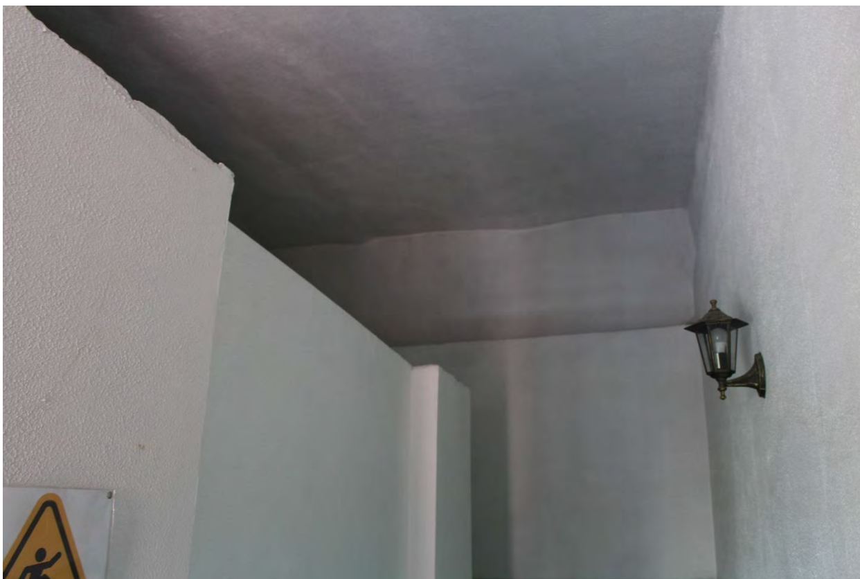
Фото 133. Западная лестничная клетка дворового корпуса выявленного объекта культурного наследия «Манеж и конюшни лейб-гвардии Гренадерского полка (здание тира лейб-гвардии Стрелкового батальона)». Фото 22.05.2023 г.
