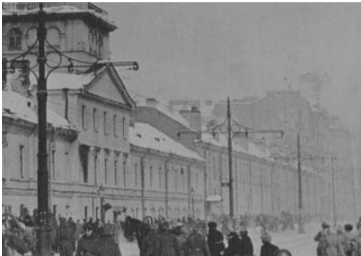
Илл. 32. Фасад Московской пожарной части и полицейского участка (Загородный пр., 37) после пожара. 1917 г. Фрагмент (источник: госкаталог.рф № 39860564).
