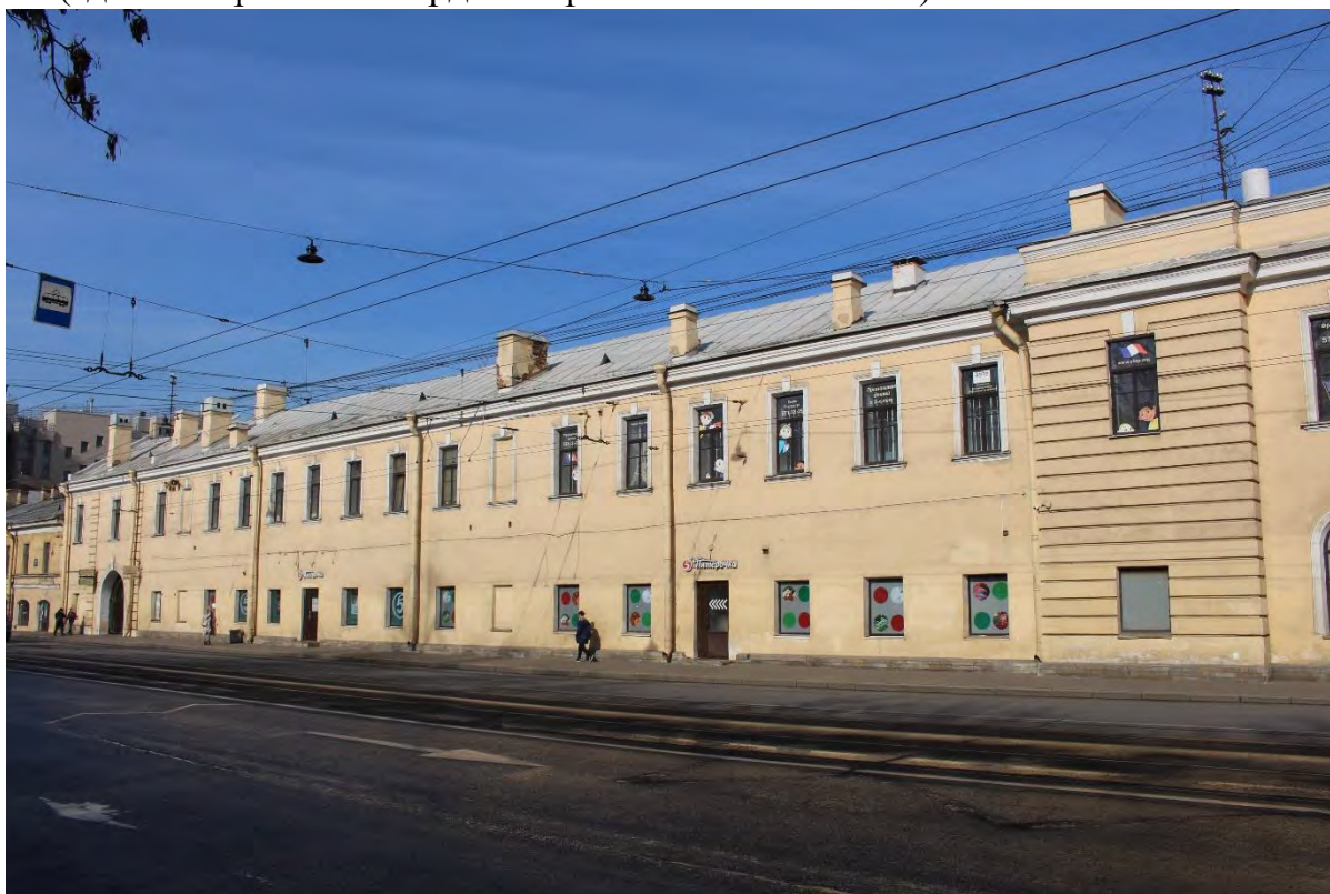
Фото 2. Вид на южную часть юго-восточного фасада лицевого корпуса выявленного объекта культурного наследия «Манеж и конюшни лейб-гвардии Гренадерского полка (здание тира лейб-гвардии Стрелкового батальона)». Фото 17.04.2023 г.
