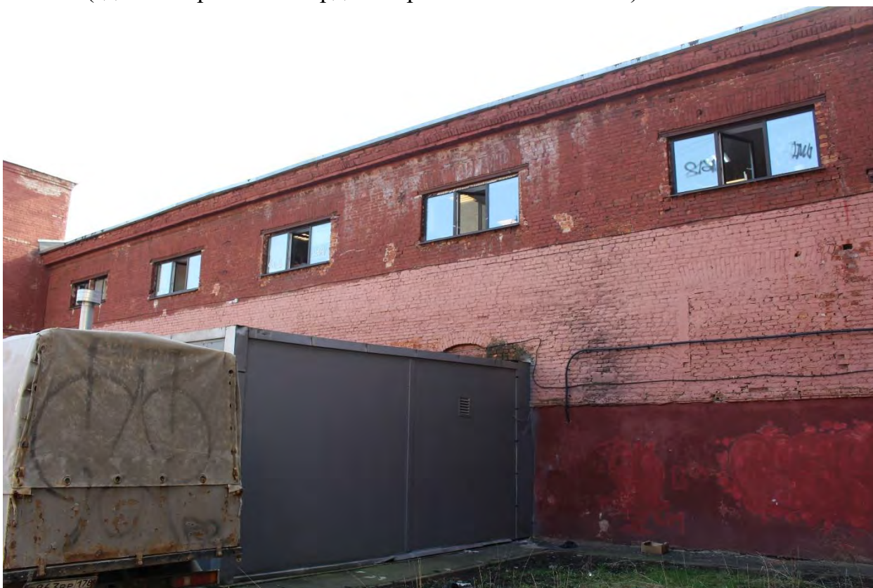
Фото 29. Вид на северо-западный фасад дворового корпуса выявленного объекта культурного наследия «Манеж и конюшни лейб-гвардии Гренадерского полка (здание тира лейб-гвардии Стрелкового батальона)». Фото 17.04.2023 г.
