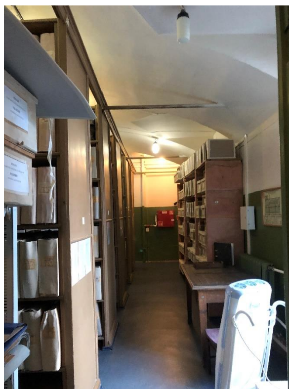
Фото 36. Второй этаж. Помещение № 2 (15-Н).
