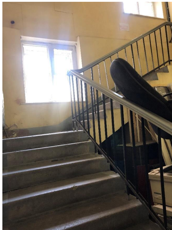
Фото 12. Первый этаж. Западная лестница 7-Н.
