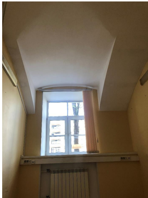
Фото 2. Первый этаж. Помещение № 22 (7-Н).
