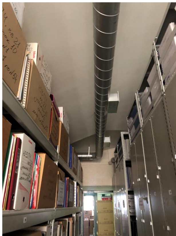
Фото 8. Первый этаж. Помещение № 15 (7-Н).
