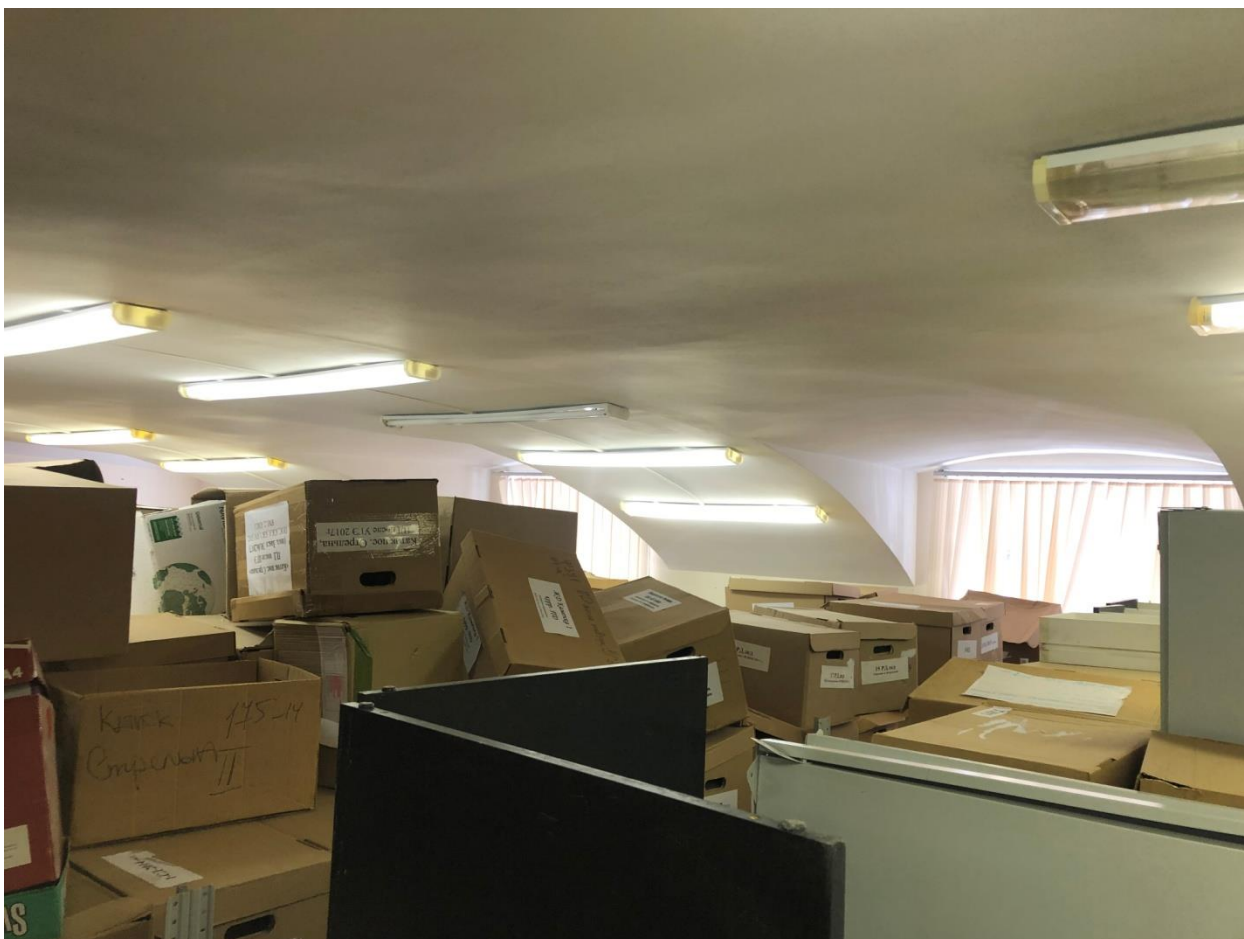
Фото 4. Первый этаж. Помещение № 12-13 (7-Н).
