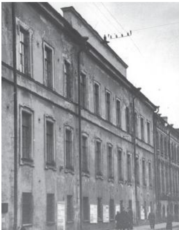
Илл. 14. Лицевой фасад по пер. Пирогова, 5. Дата: 1924 г. Источник: Буклет "Центральный государственный исторический архив Санкт-Петербурга (ЦГИА СПб)", 2011.
