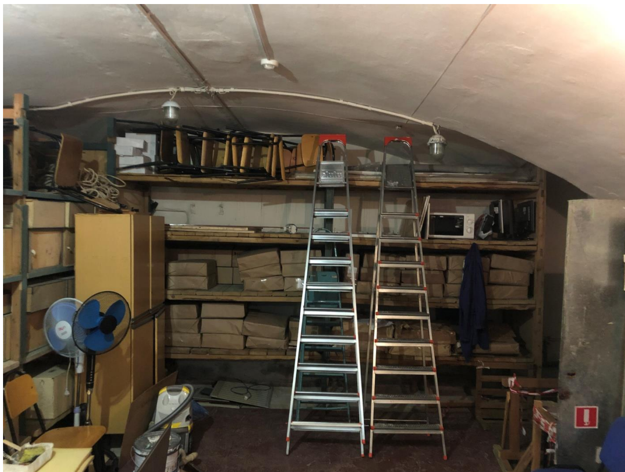
Фото 13. Первый этаж. Помещение № 7 (8-Н).
