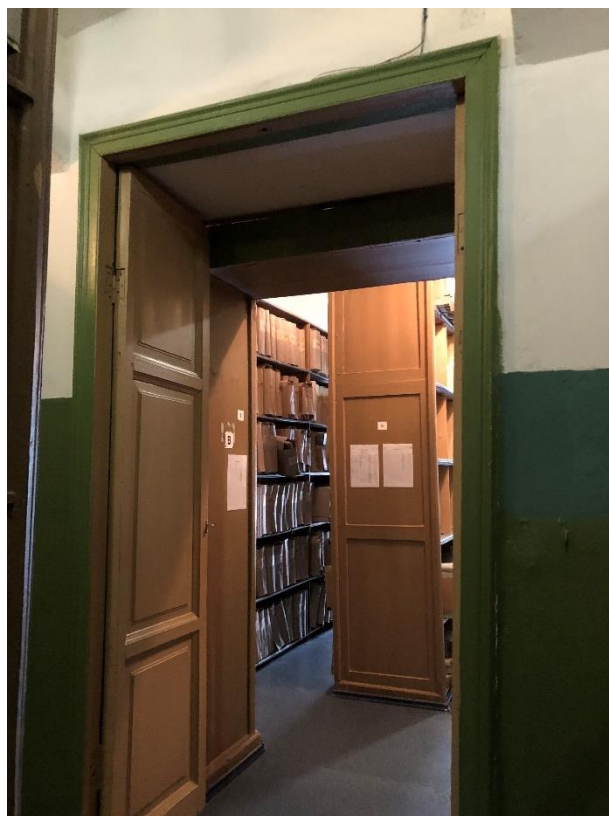
Фото 34. Второй этаж. Дверной проем между помещениями 5 и 4 (15-Н).
