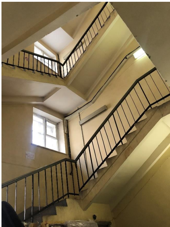
Фото 11. Первый этаж. Западная лестница 7-Н.
