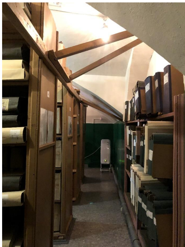
Фото 17. Первый этаж. Помещение № 5 (8-Н).
