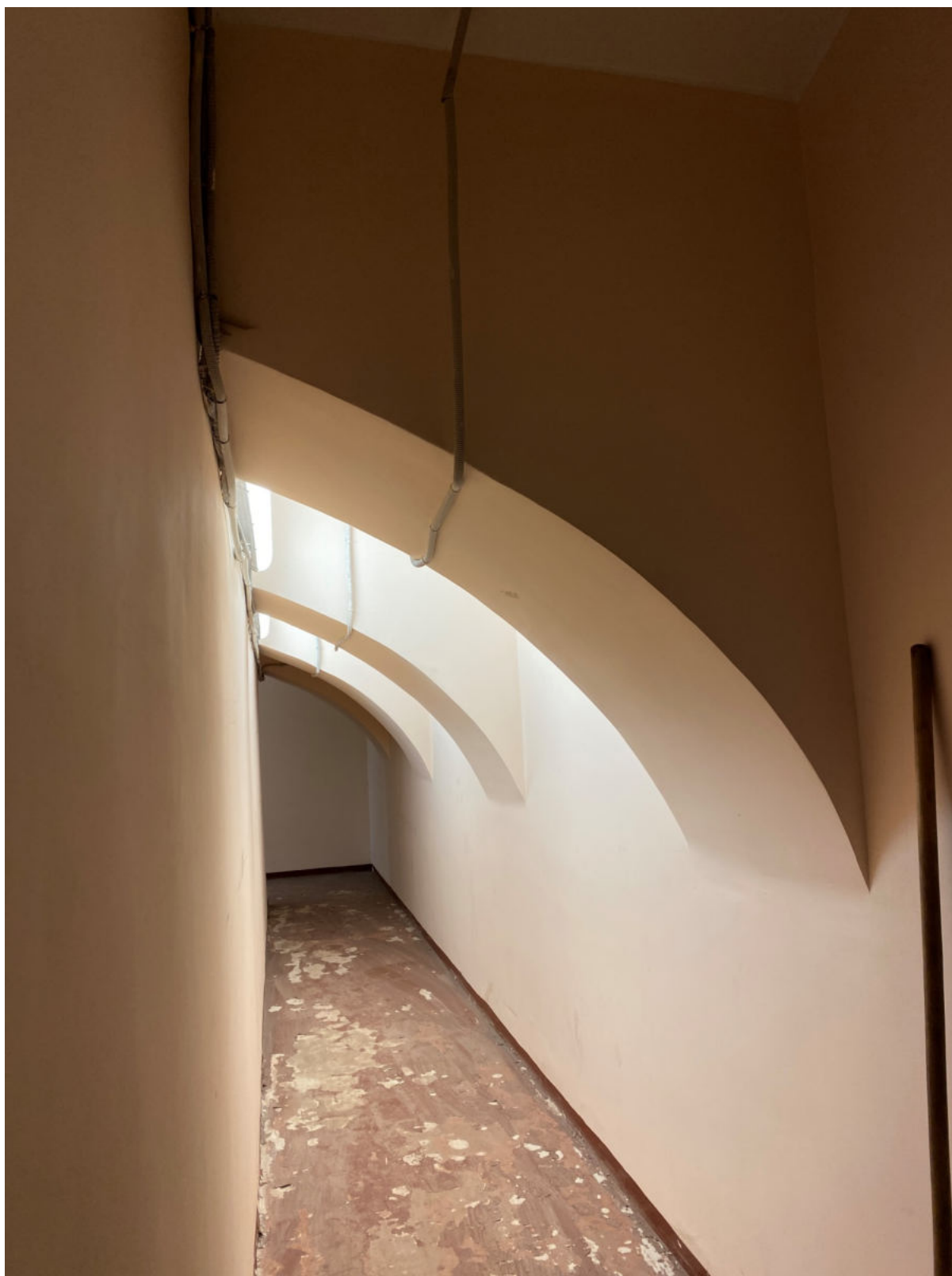
33. Общий вид помещений цокольного этажа
