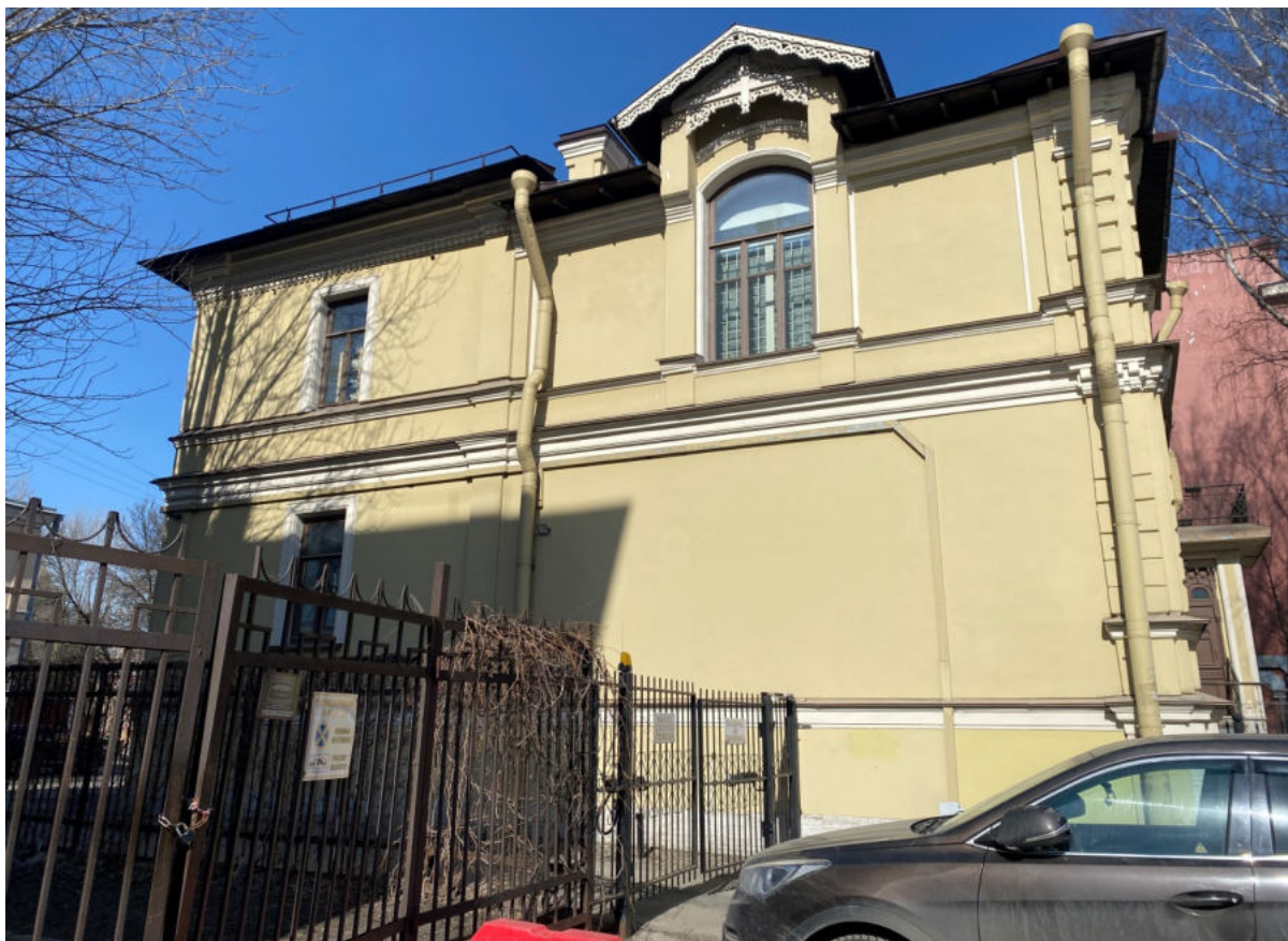
3. Общий вид южного бокового фасада
