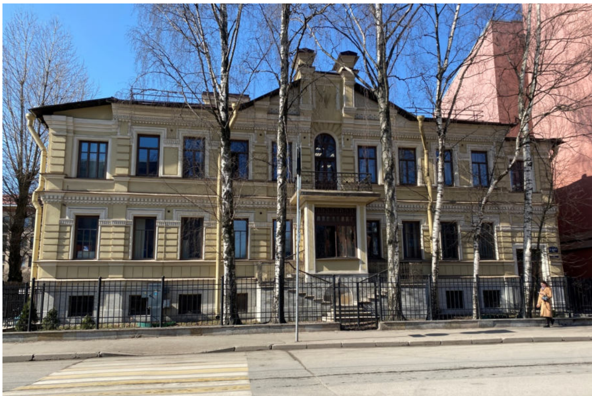
1. Общий вид лицевого фасада по Дровяной улице
