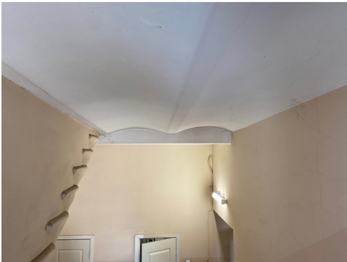
21. Верхнее перекрытие лестницы 1ЛК в уровне 2-го этажа
