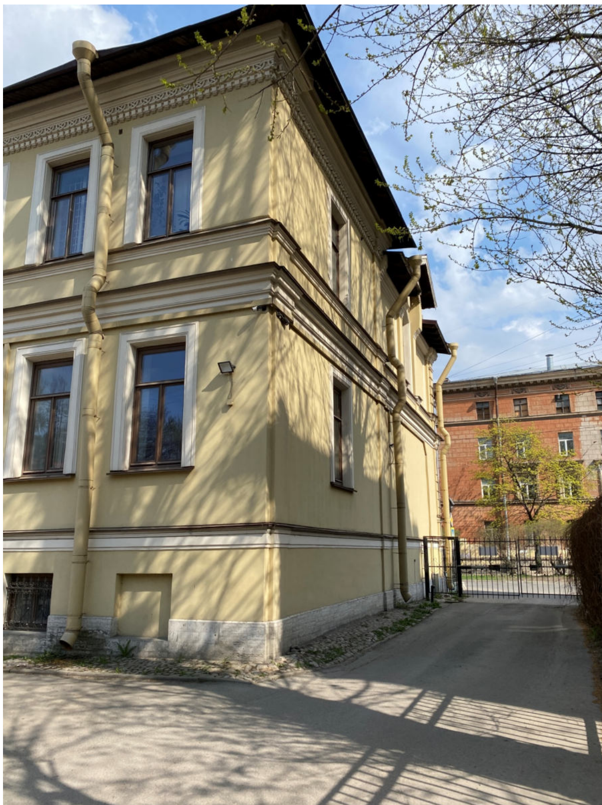
7. Фрагмент южного бокового и западного дворового фасадов
