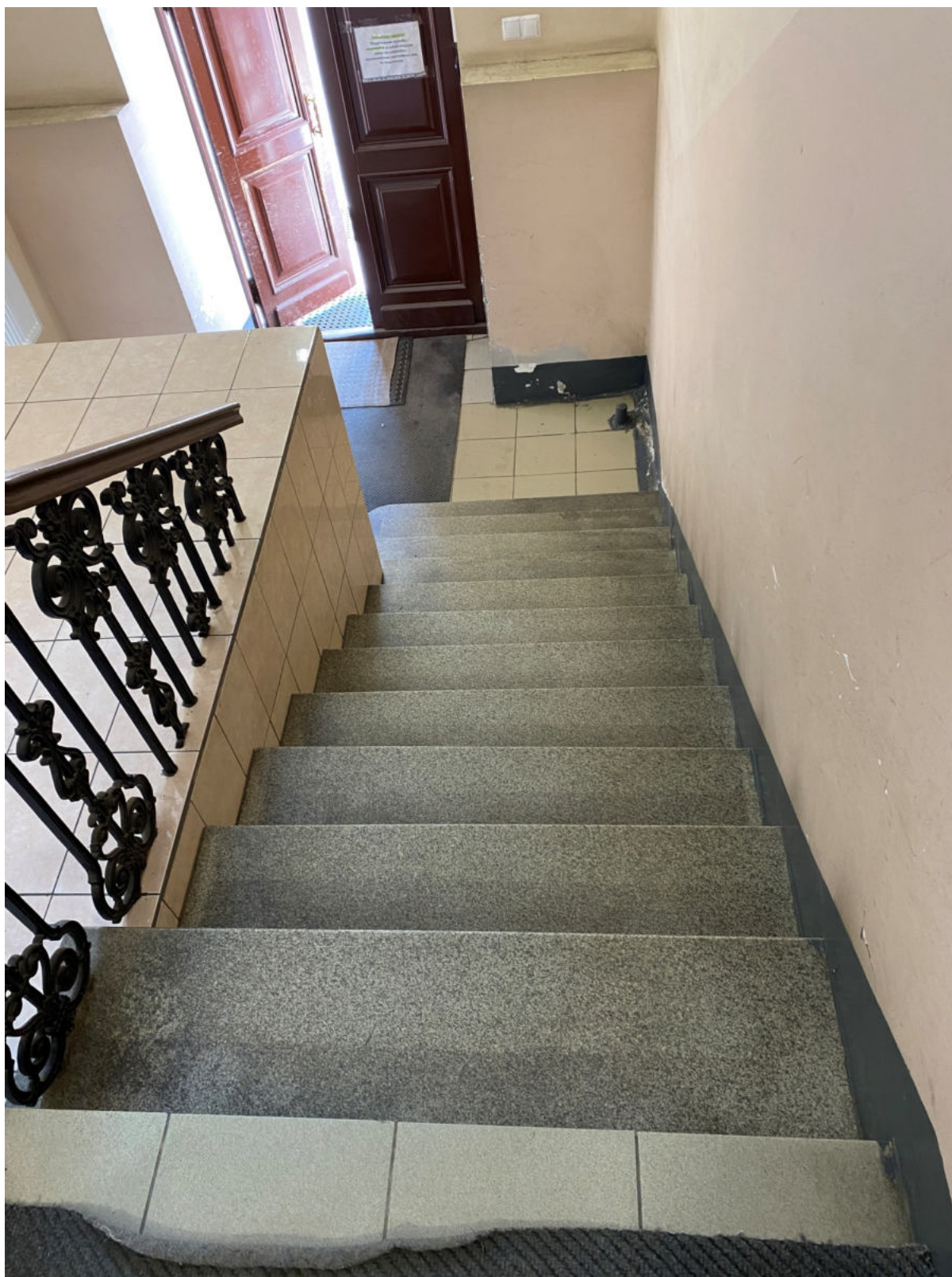
19. Фрагмент лестницы 1ЛК в уровне 1-го этажа
