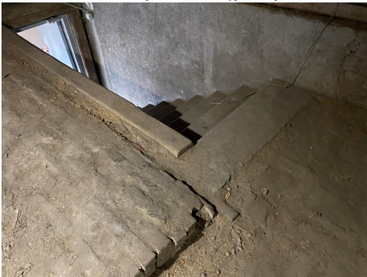
26. Лестница, ведущая с чердака на лестницу 1ЛК
