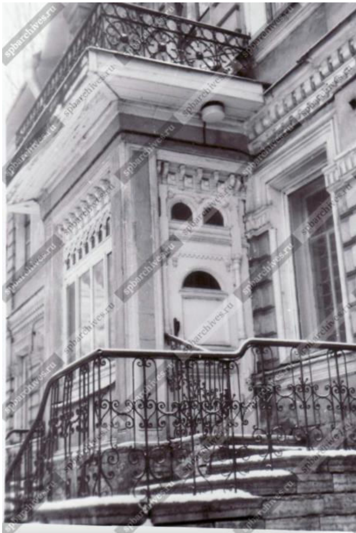
109. Застекленная терраса дома № 7-Б на Дровяной улице (бывший особняк В.Е. Грачева, архитектор А.В. Малов, 1888 год), 2001 г. – ЦГАКФФД СПб – Фотодокумент Ар 212264
