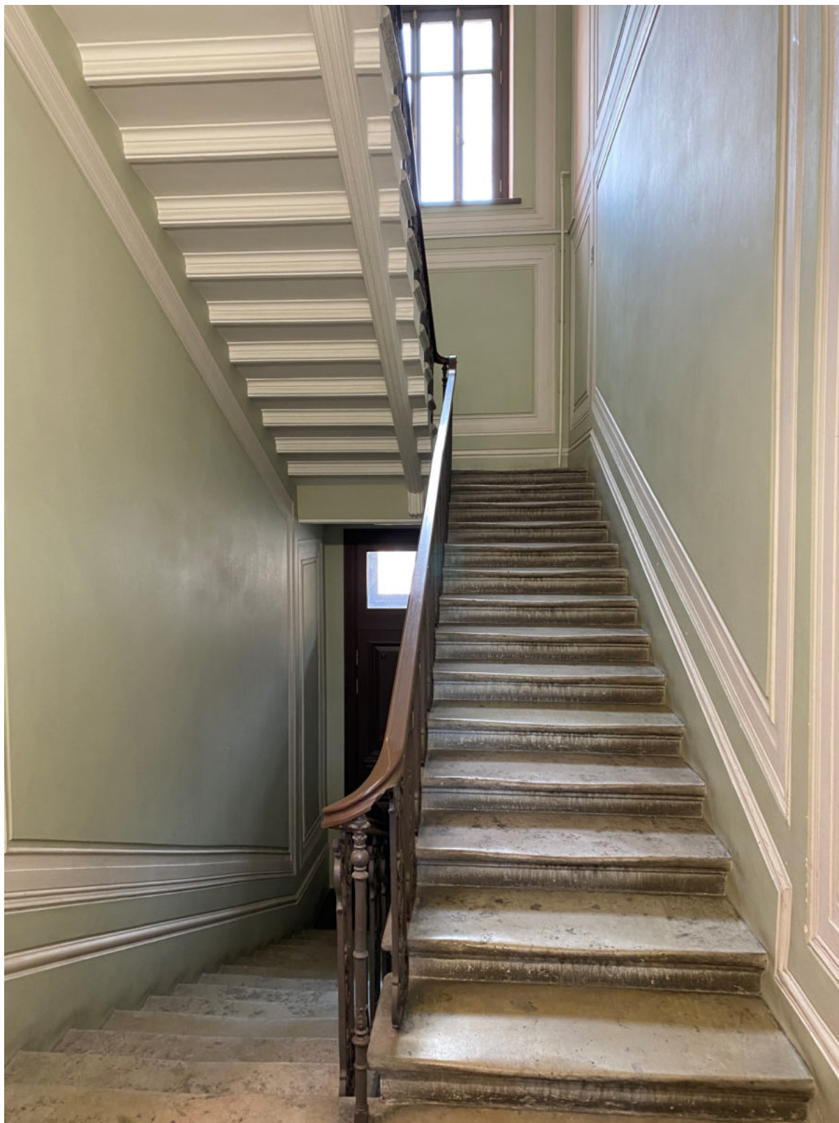
27. Лестница 2ЛК в уровне первого этажа
