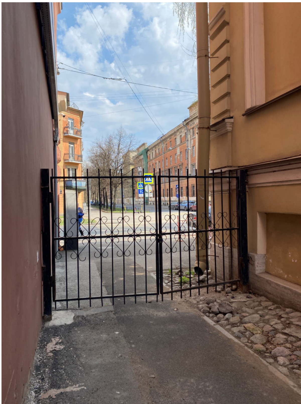
14. Воротный проезд, примыкающий к северному боковому фасаду В
