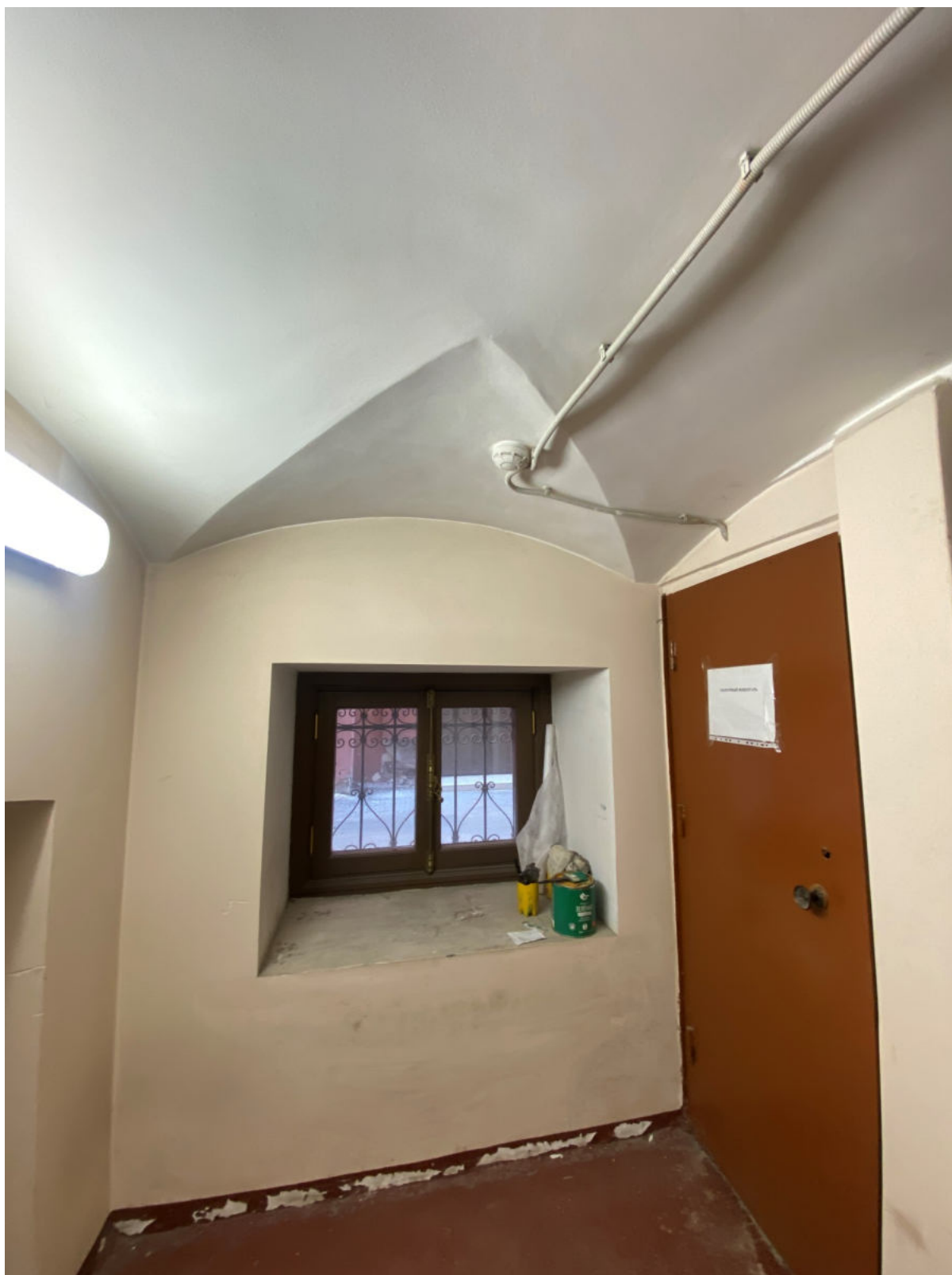
32. Общий вид помещений цокольного этажа
