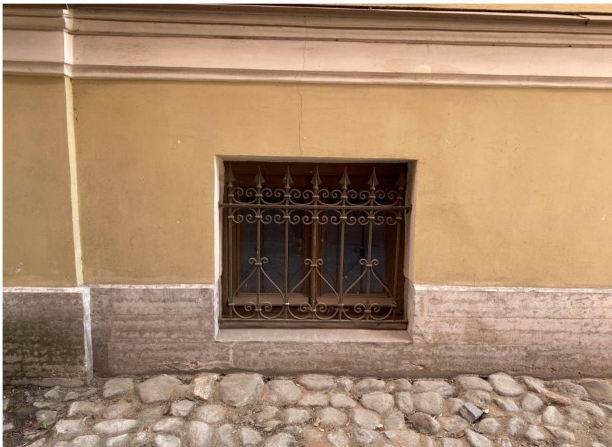
12. Фрагмент северного бокового фасада
