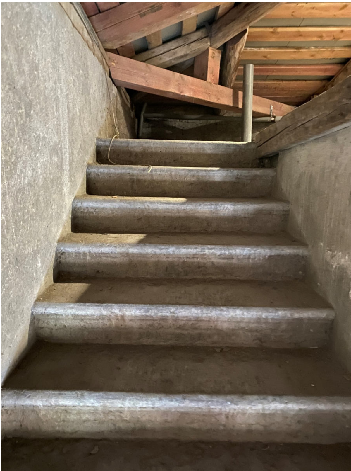
22. Лестница, ведущая на чердак с лестницы 1ЛК
