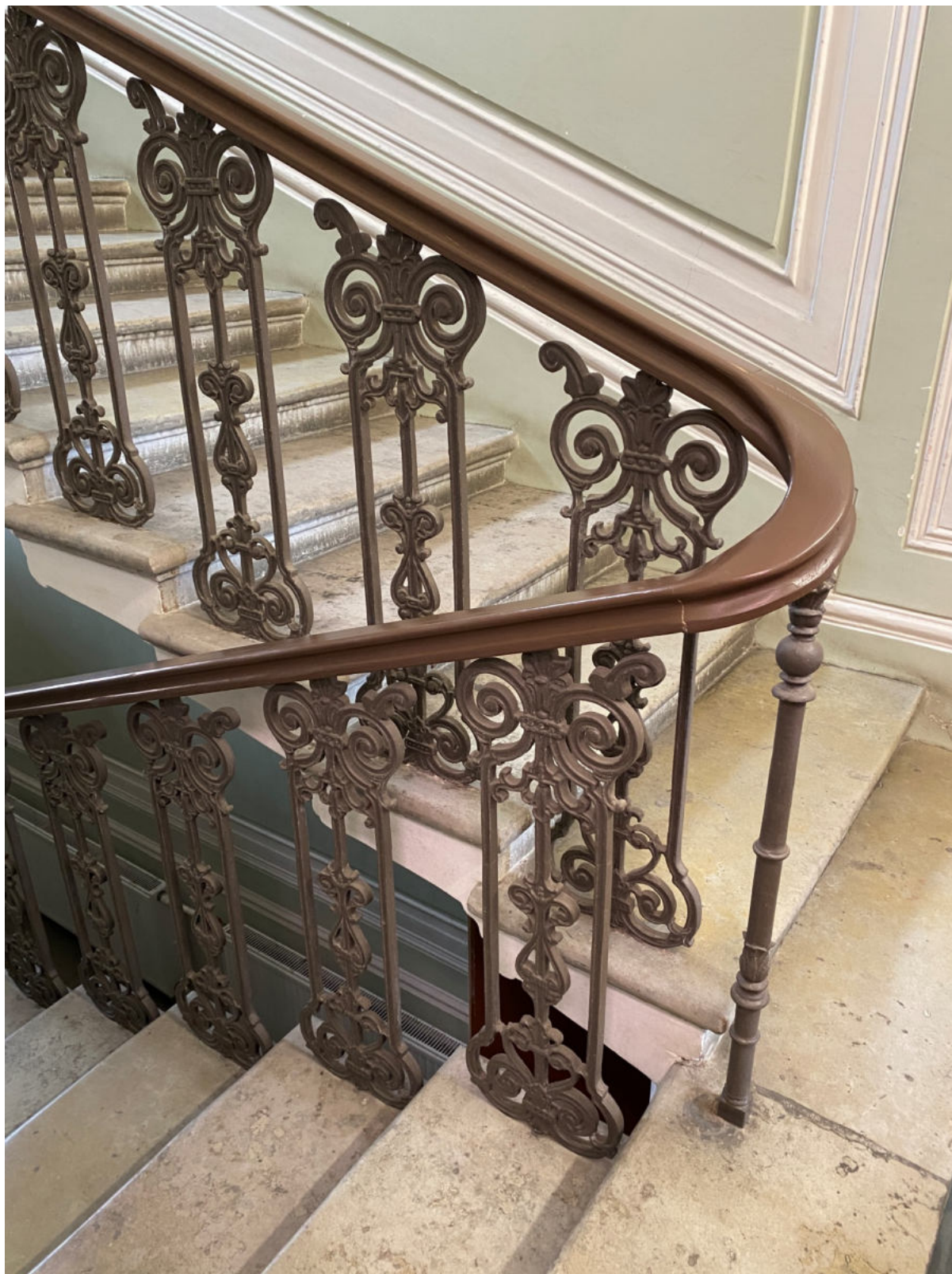
28. Фрагмент ограждений лестницы 2ЛК в уровне 1-го этажа
