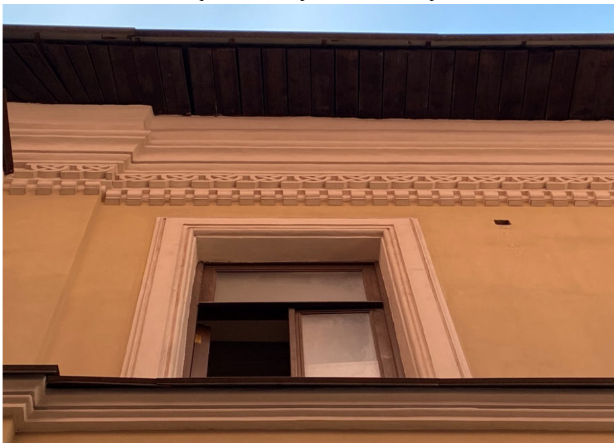
13. Фрагмент северного бокового фасада
