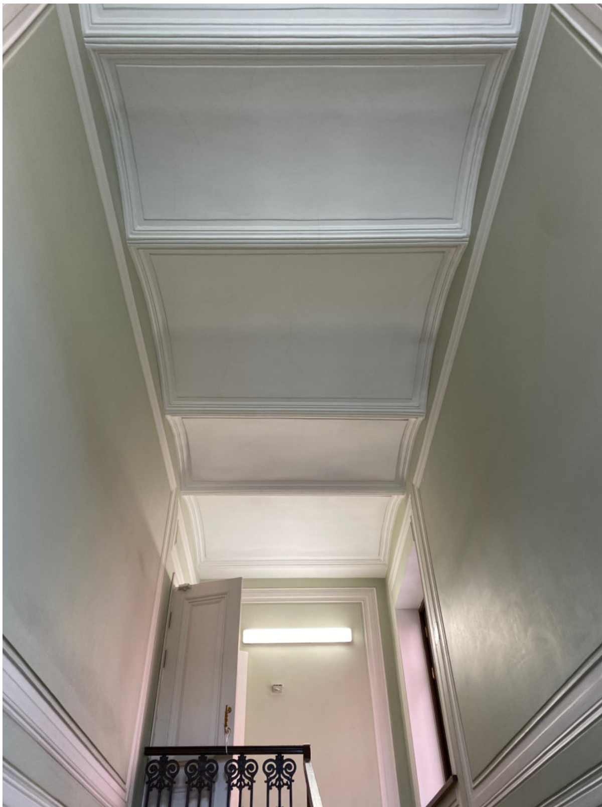
38. Вид на верхнее перекрытие лестницы 2ЛК в уровне 2-го этажа
