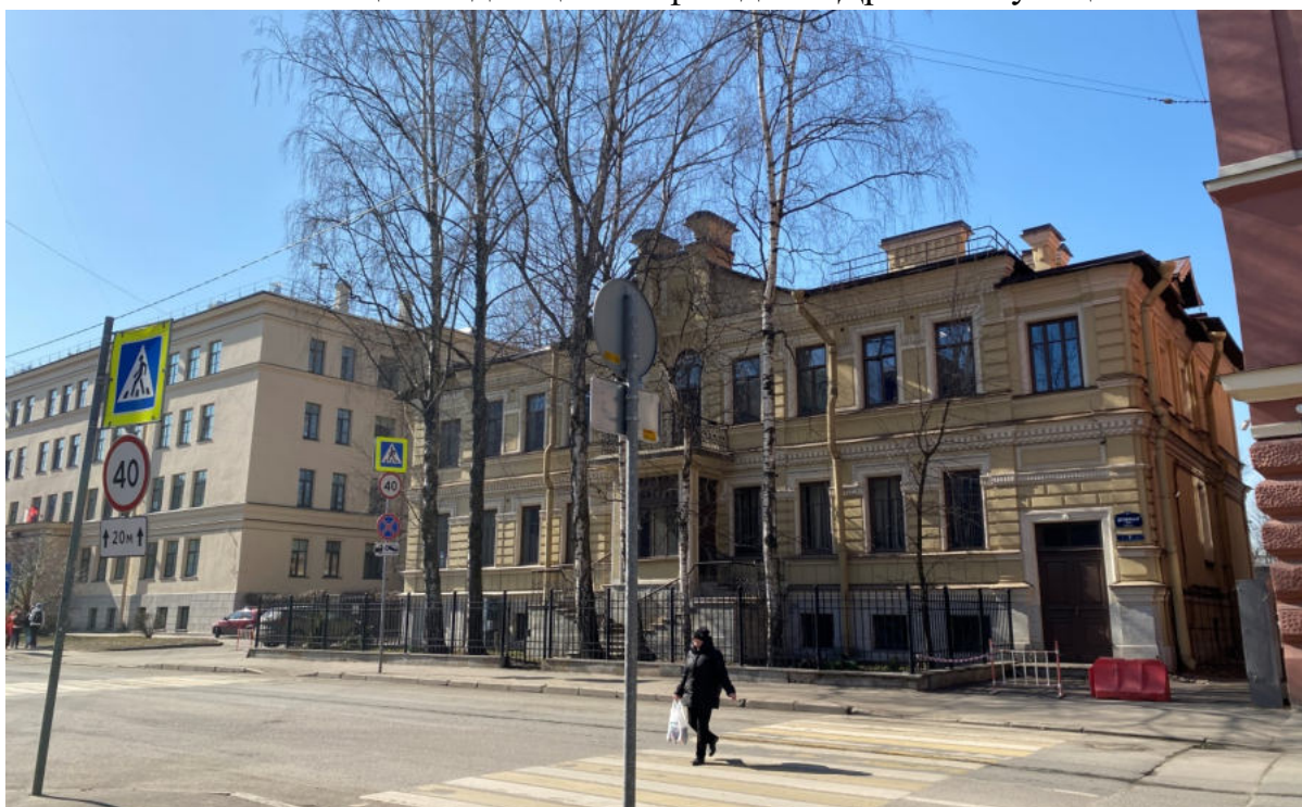
2. Общий вид лицевого фасада по Дровяной улице
