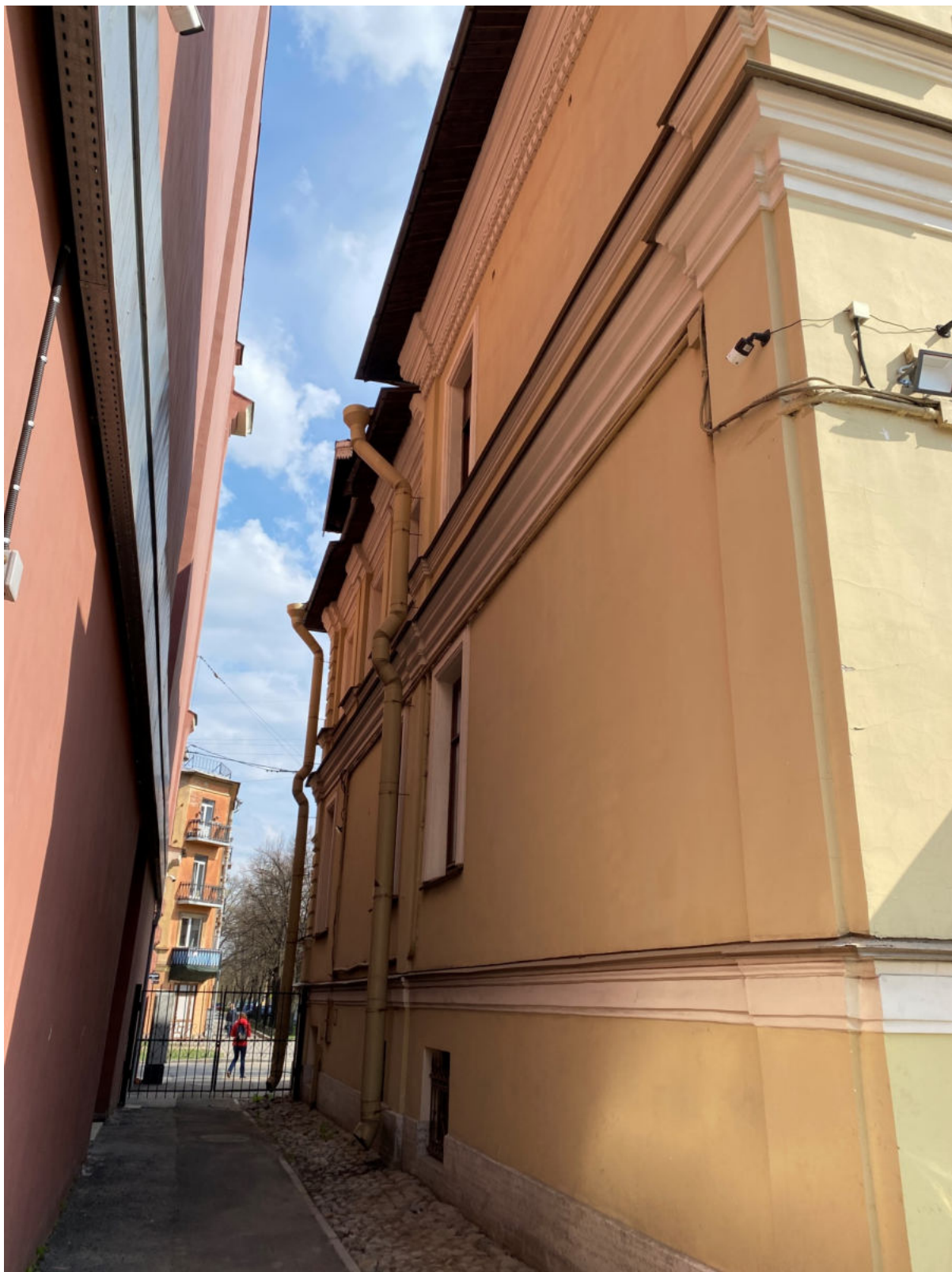
11. Общий вид северного бокового фасада
